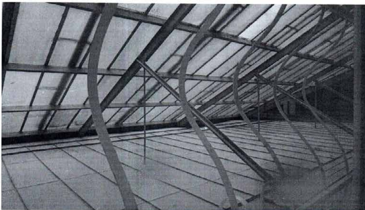
38. Конструкции светового фонаря над галереей центрального двора-атриума. Вид с запада.
