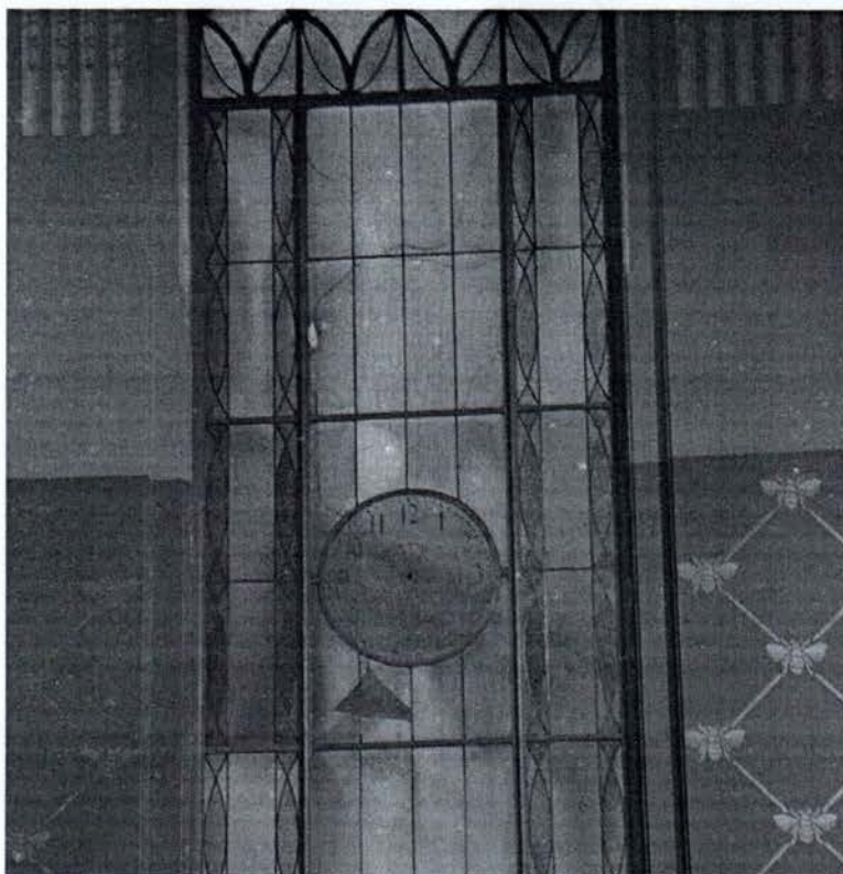
50. Витражные заполнения «Операционного зала»: наблюдаются трещины, утраты отдельных элементов, загрязнения; утрачены стрелки часов на витраже.
