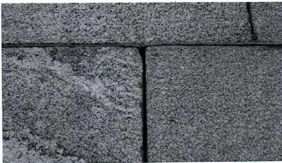
3. Объект культурного наследия. Фрагмент цоколя со стороны лицевого фасада по Большой Морской ул. Участок с выветриванием шовного заполнения.
