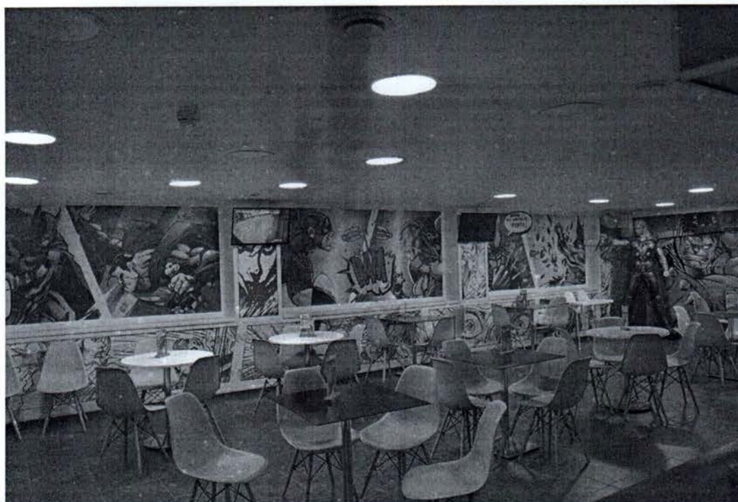
49. В уровне первого этажа пом. 3-Н ч. п. 137 («Операционный зал») пол покрыт современной керамической плиткой, переплет светового фонаря перекрытия защит современным подвесным потолком, стены обшиты современными материалами, расписаны, оконные заполнения защиты со стороны помещения.
