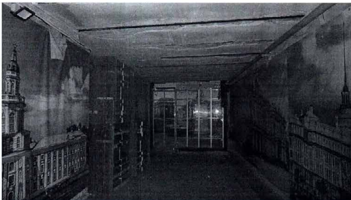
18. Объект культурного наследия. Перекрытие над проездом из северного двора в северо-западный двор с утратами штукатурного слоя, с коррозией металлических балок и утратами окраски. Стены внутридворового проезда заклеены баннерами, по южной стене проведены не убранные в короб провода и установлены осветительные приборы.
