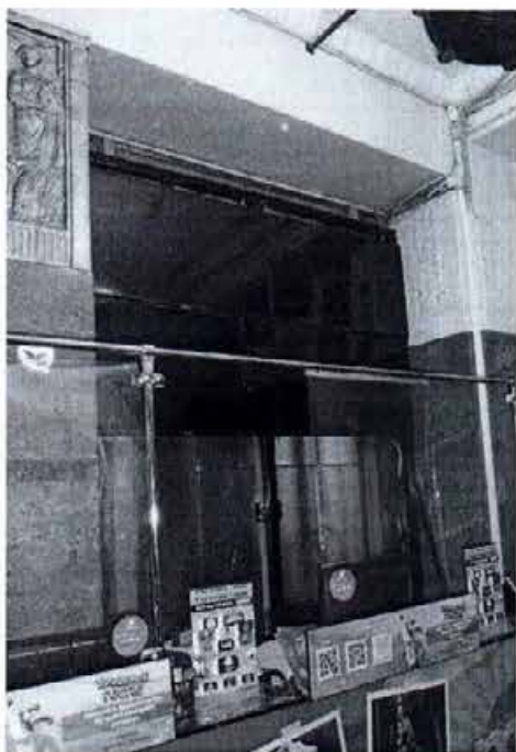
69. Двустворчатое дверное заполнение с прямоугольной фрамугой (Л-1 между ч. п. III и IV), со стороны ч. п. III к двери примыкает металлическая современная конструкция, прикрепленная к металлическим дверям, поддерживающая 4 телевизора.
