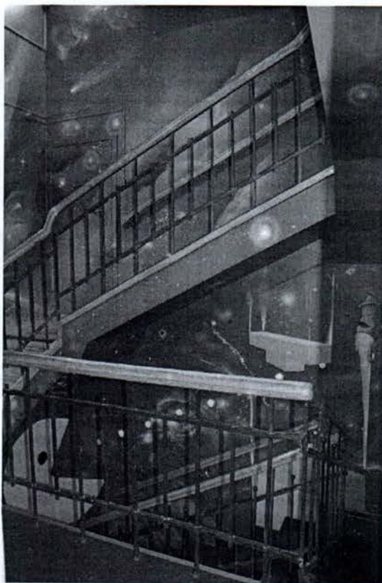
65. Стены на лестничной клетке пом. 3-Н ч. п. 108 расписаны, площадки лестницы защиты современными материалами, ступени облицованы деревом, лестничные марши подшиты снизу современными материалами, расписаны.
