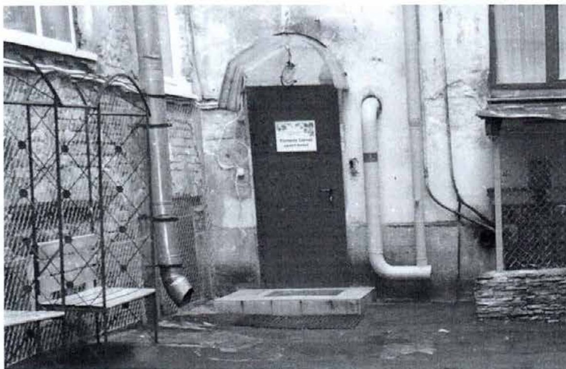
21. Современный светопрозрачный козырек над дверным проемом (Л-2), диссонирующий с историческим обликом здания. Западный фасад западного дворового корпуса объекта культурного наследия (слева на фотографии): утраты штукатурного слоя, выветривание шовного заполнения кирпичной кладки в нижней части стен.
