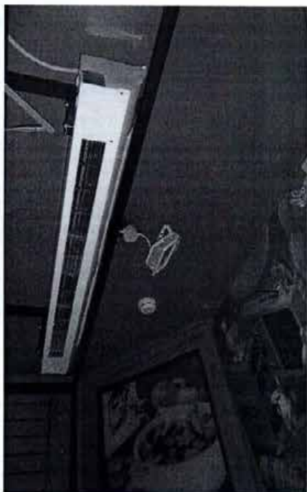
67. Внутри южного тамбура установлена дополнительная металлическая каркасная конструкция, крепящаяся к полу, к стенам и потолку тамбура, к которой прикреплены внутренний блок кондиционера и лампа дополнительного освещения.
