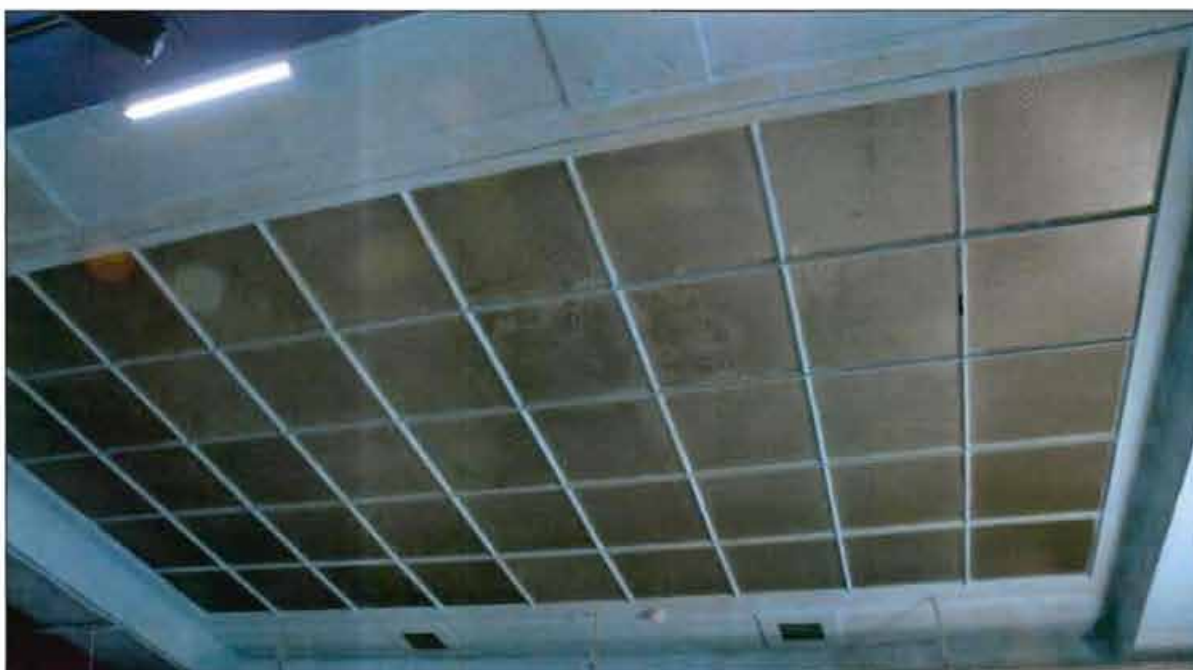
16. Металлические рамы светового фонаря в «Операционном зале».
