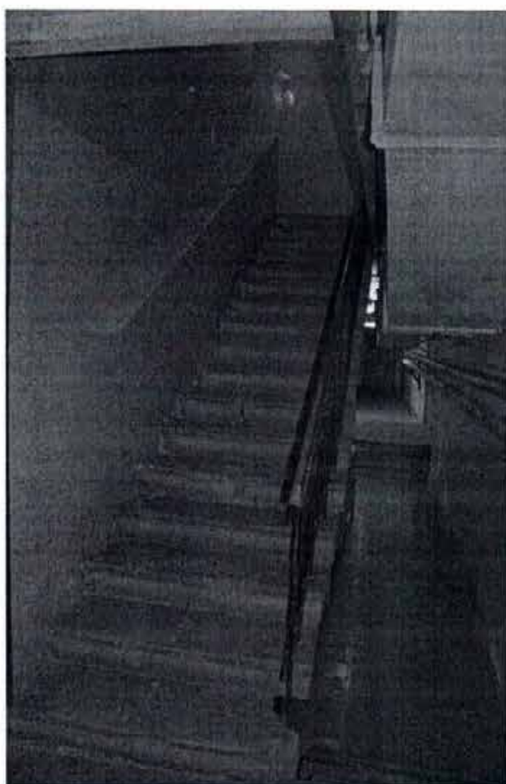
63, 64. Лестница в западном дворовом корпусе (пом. 3-Н ч. п. 75). На нижнем лестничном марше наблюдаются: сколы ступеней, сквозные трещины нескольких ступеней (с нижней стороны марша укреплены металлическими скобами).
