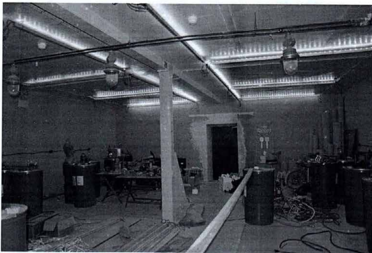
33. Подвал. Демонтированы перегородки в пом. 40-Н между ч. п. 15-22 (объединены в одно помещение), в капитальной стене устроен дверной проем между пом. 40-Н ч. п. 22 и пом. 3-Н ч. п. 34.
