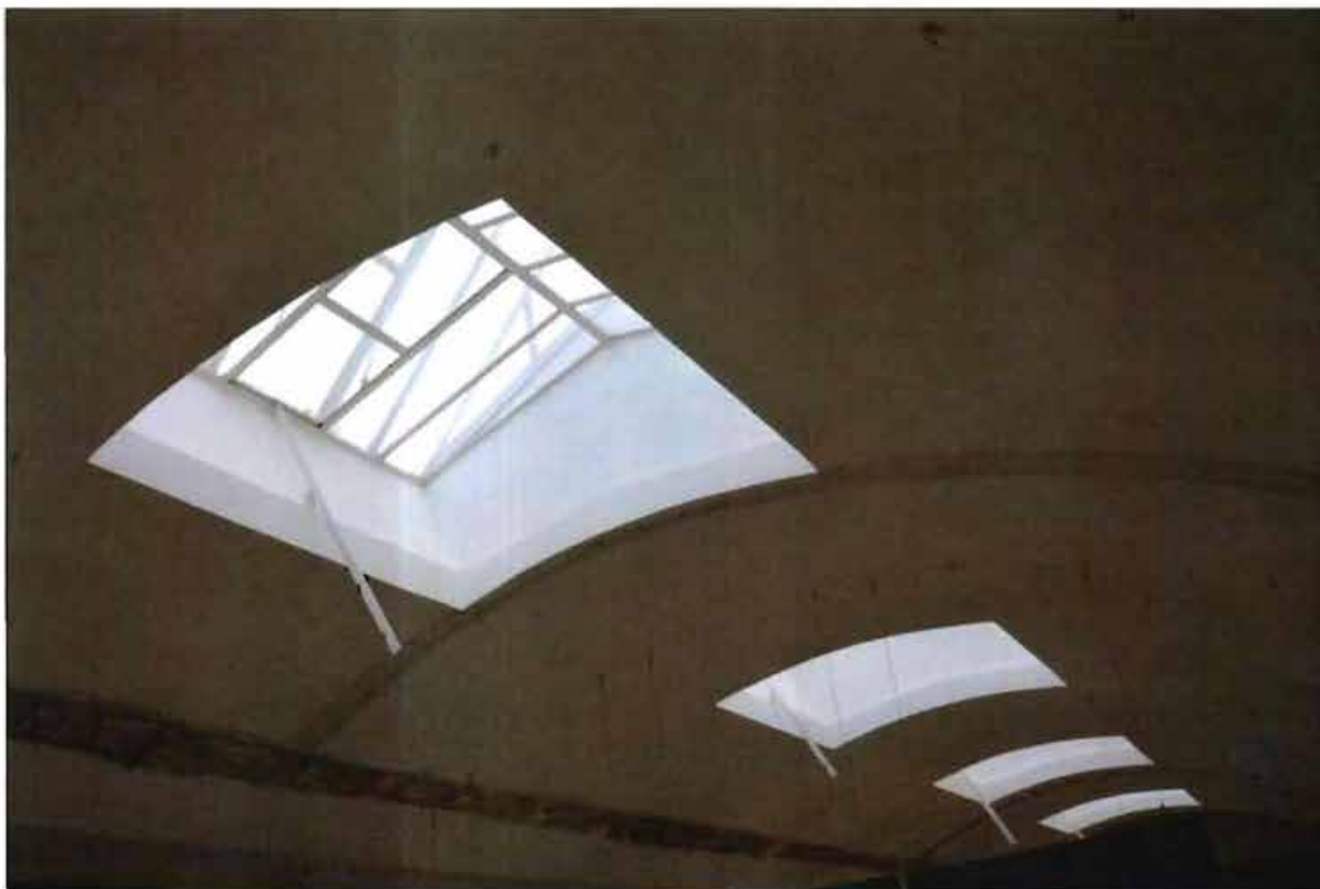
14. Световые фонари и сводчатое перекрытие мансардного этажа северного поперечного корпуса.
