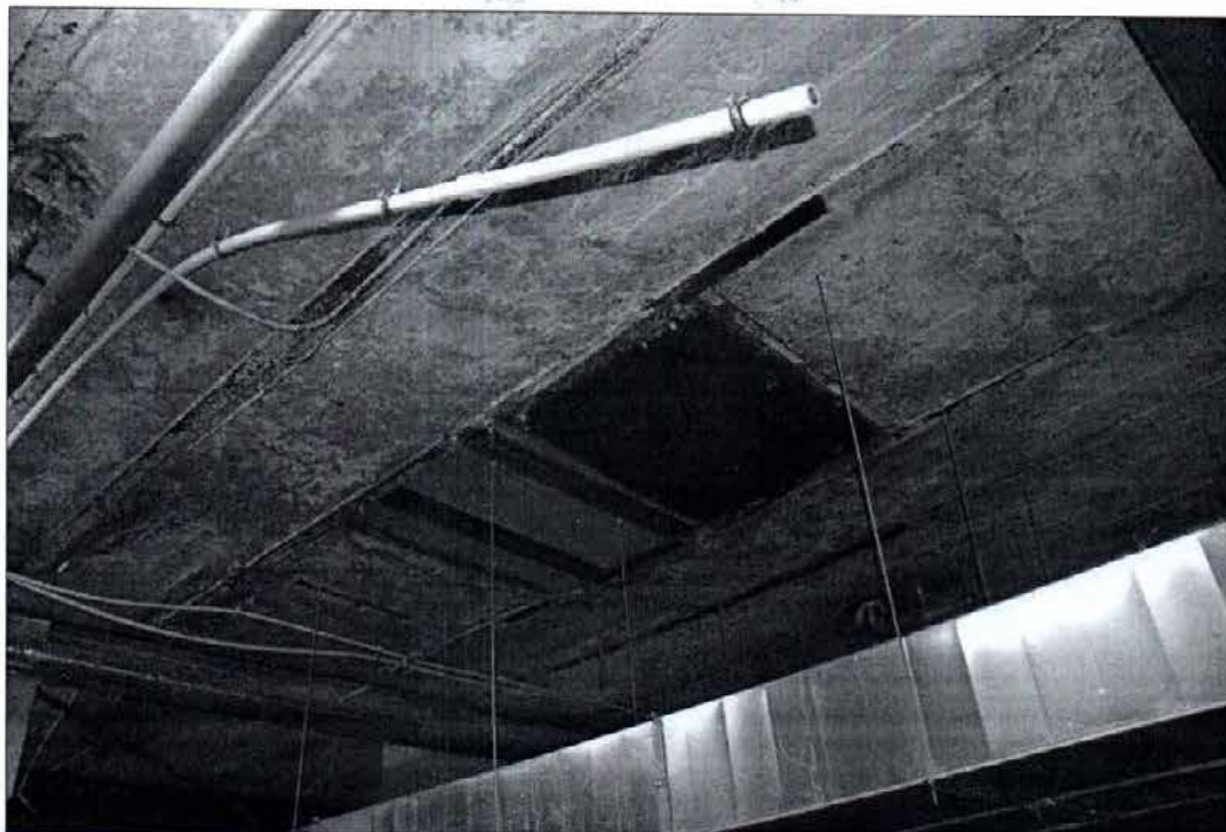
30. Подвал. В пом. 3-Н (ч. п. 13) наблюдаются утраты штукатурной отделки до обнажения металлических балок, коррозия металла, следы увлажнений, участок подвального перекрытия подшит современными материалами.
