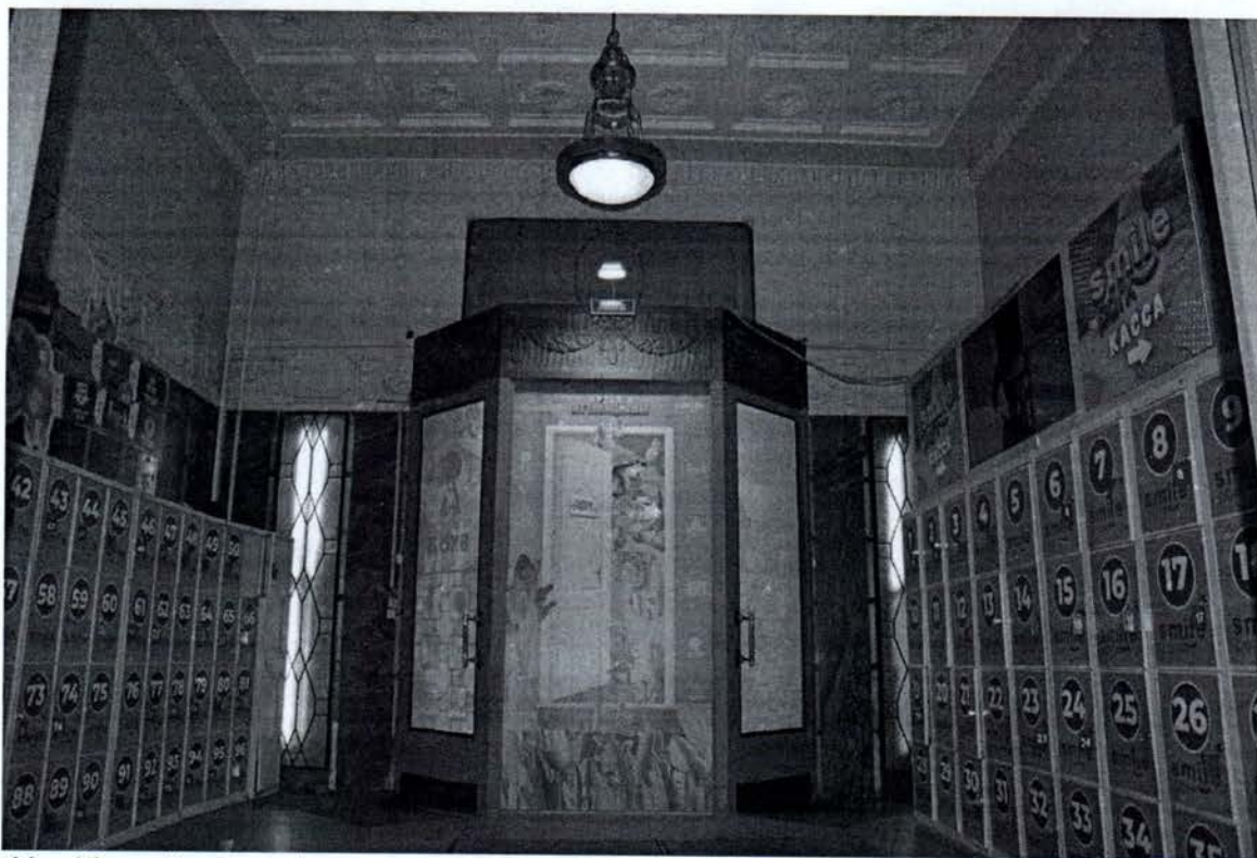
66. Южный вестибюль с тамбуром. Дополнительный осветительный прибор с подведенными проводами установлен над перекрытием тамбура. Остекление тамбура заклеено рекламой.
