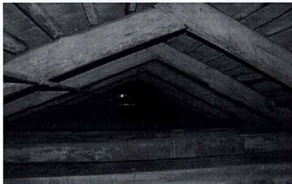
42. Деревянная стропильная система над северной частью лицевого корпуса по Большой Морской ул.
