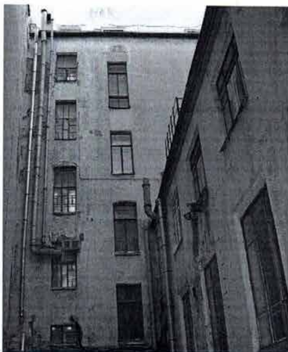
13. Объект культурного наследия. Западный фасад лицевого корпуса, выходящий в северный двор (слева на фото): металлические трубы и блок воздуховода по первой световой оси, металлическая труба воздуховода по второй световой оси, не убранные в короба провода; северный фасад северного поперечного дворового корпуса, выходящий в северный двор (справа на фото): имеется металлическая труба воздуховода по первой световой оси (выходящая из оконного проема в уровне первого этажа, диссонирующая с историческим обликом здания), имеются две видеокамеры в уровне второго этажа по второй световой оси, диссонирующие с историческим обликом здания.
