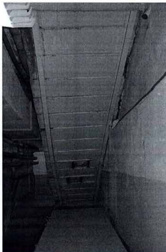
63, 64. Лестница в западном дворовом корпусе (пом. 3-Н ч. п. 75). На нижнем лестничном марше наблюдаются: сколы ступеней, сквозные трещины нескольких ступеней (с нижней стороны марша укреплены металлическими скобами).
