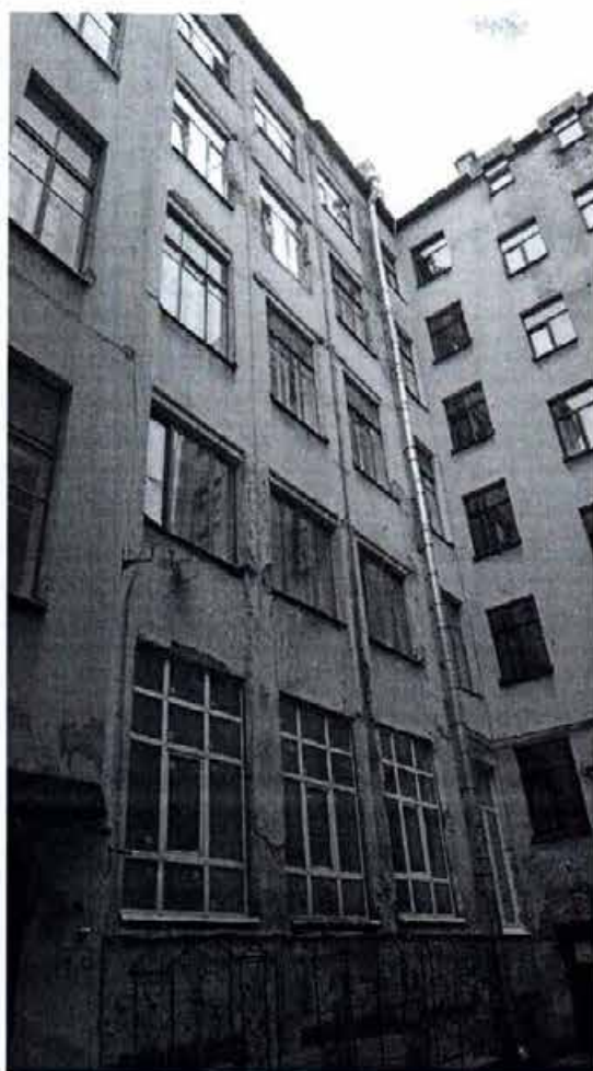
17. Объект культурного наследия. Фрагмент западного фасада западного дворового корпуса, выходящего в северо-западный двор. Под оконными проемами в уровне первого этажа проведены не убранные в короб провода.
