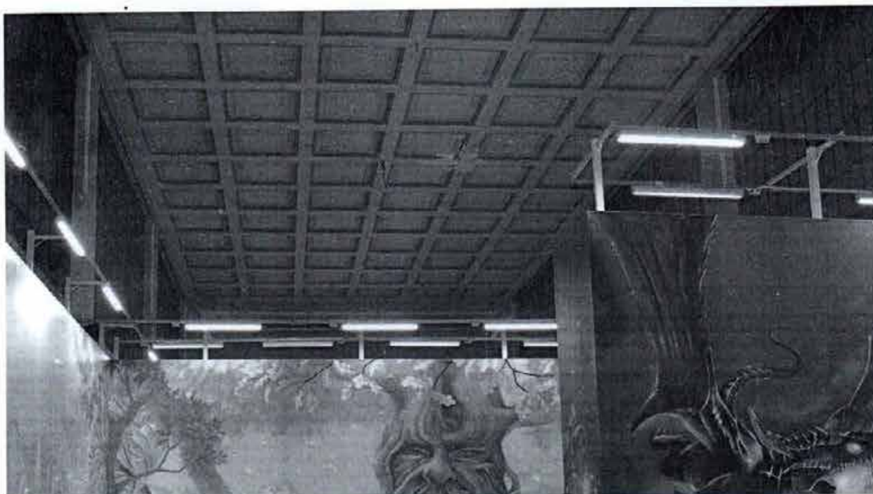
45. «Операционный зал». Пилоны и стены в нижней части зашиты современными материалами, наблюдаются утраты штукатурного и окрасочного слоя на перекрытии.
