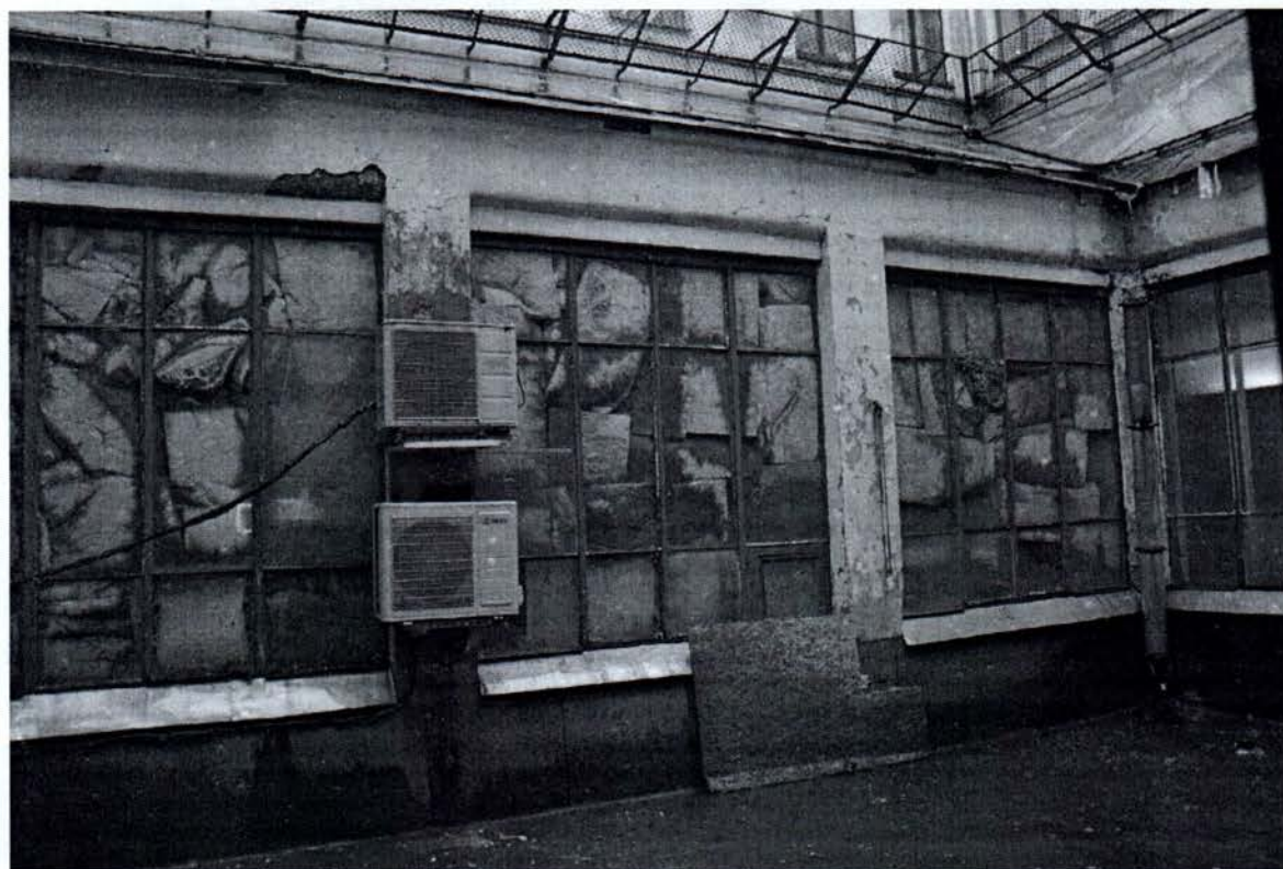
25. Объект культурного наследия. Центральный двор. Западный фасад одноэтажного объема световой галереи лицевого корпуса в уровне первого этажа: утрачено остекление оконных проемов, заменено фанерой и другими современными материалами (в границах пом. 3-Н ч. п. 137); между 1-й и 2-й световыми осями установлены два блока кондиционеров на металлических кронштейнах.
