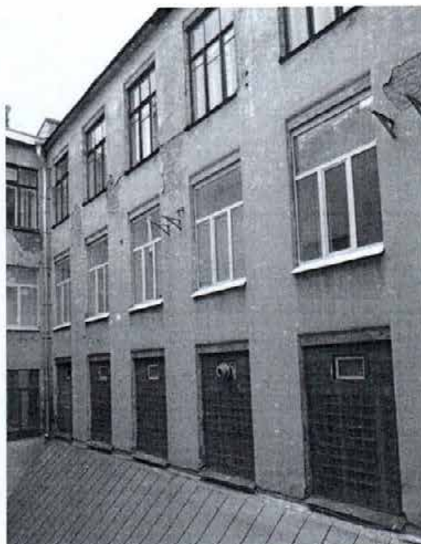
28. Объект культурного наследия. Конструкции световых фонарей над южной одноэтажной частью здания сверху перекрыты поздней скатной кровлей (в нижней части фотографии). На южном дворовом фасаде южного поперечного корпуса (справа на фотографии), выходящем в световой колодец, в уровне 4-го этажа между 3-й и 4-й; 5-й и 6-й световыми осями установлены две пары металлических кронштейнов, диссонирующих с историческим обликом здания.
