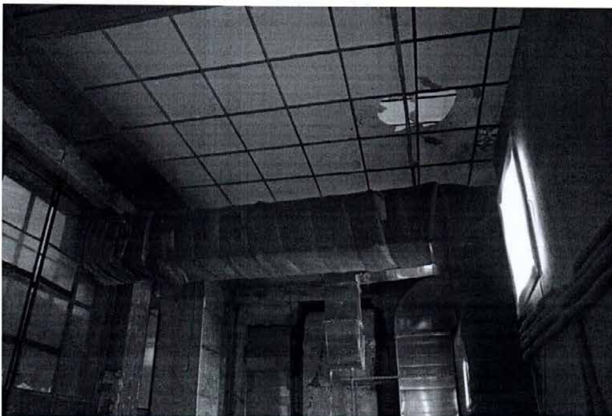
34. Пом. 3-Н ч. п. 14. Заменено матовое светопрозрачное заполнение рамы светового фонаря на современное окрашенное, наблюдаются разбитые участки остекления.
