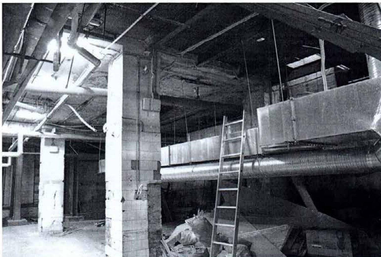
29. Подвал (пом. 3-Н ч. п. 13). У пилонов наблюдаются утраты облицовки. Часть перекрытия пом. 3-Н между ч. п. 13 (подвал) и ч. п. 14 (первый этаж) демонтирована, заменена на позднейшее (металлические листы по металлическим балкам).
