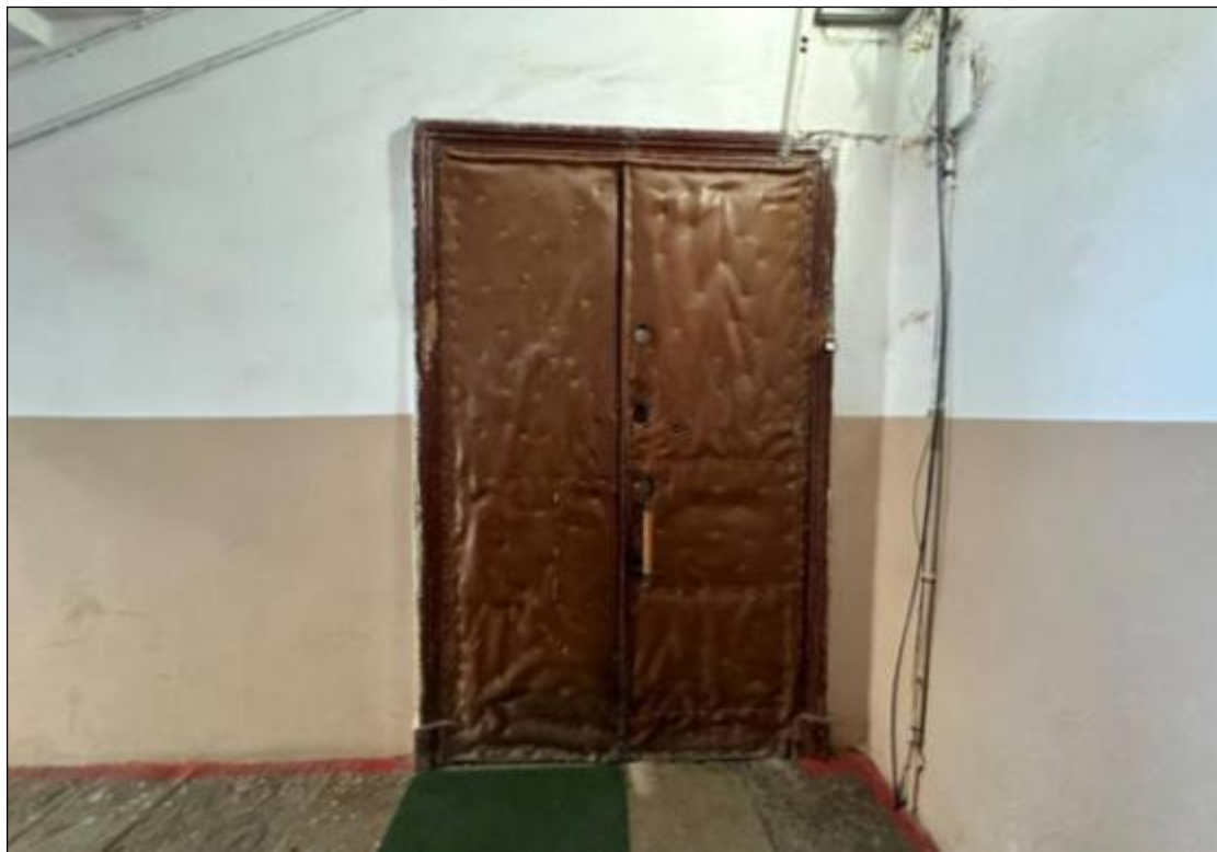
199. Выявленный объект культурного наследия «Дом В.А. Квасникова». Западный дворовый флигель. Лестница 4ЛК. Площадка 2-го этажа. Вход в квартиру № 26. 06.02.2025 г.
