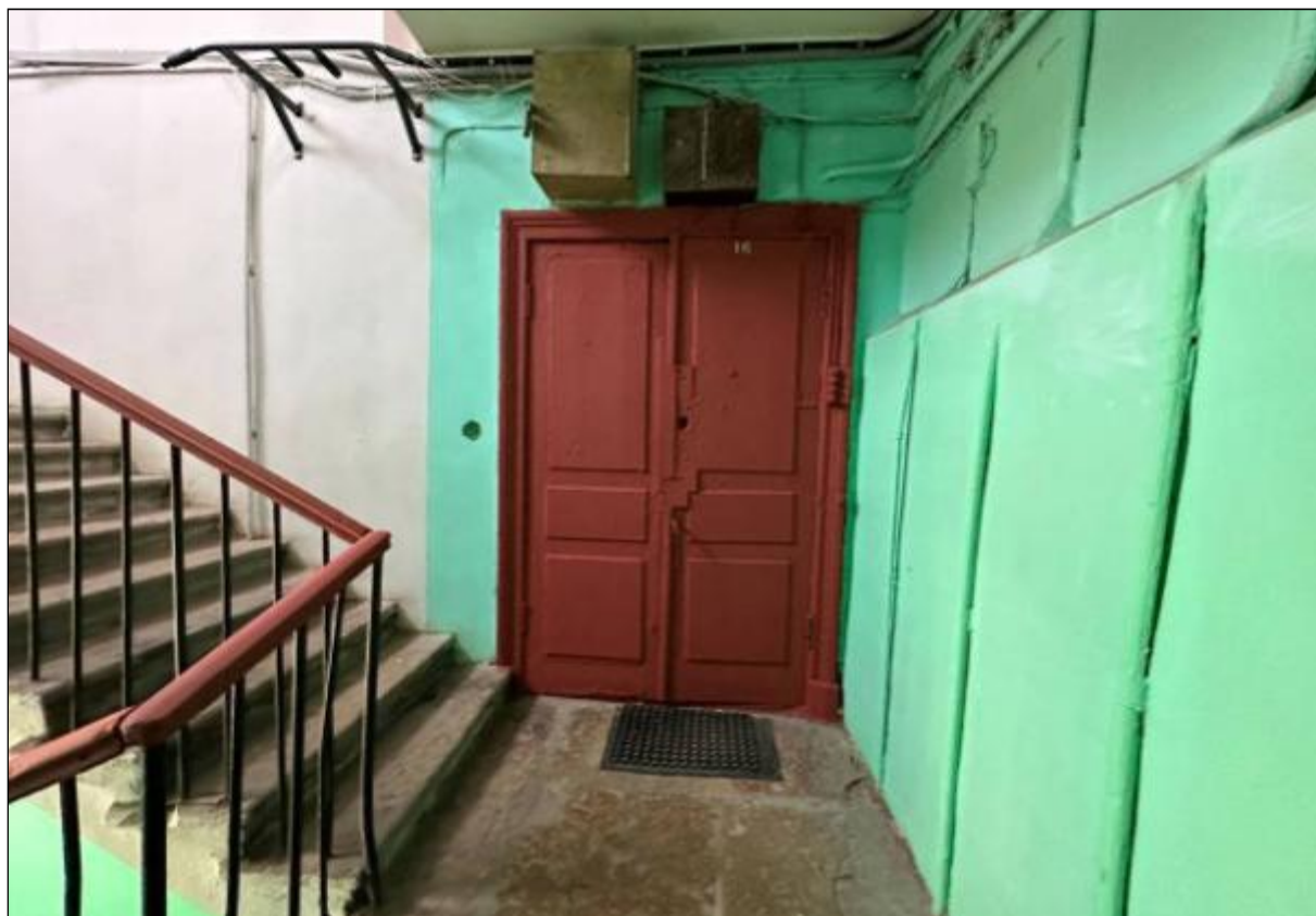
184. Выявленный объект культурного наследия «Дом В.А. Квасникова». Северный дворовый флигель. Лестница ЗЛК. Площадка 4-го этажа. Вход в квартиру № 16. 06.02.2025 г.
