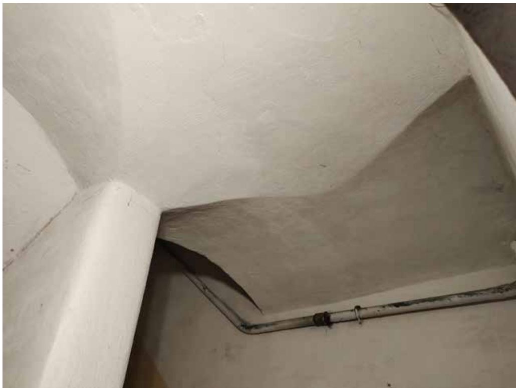
596 Выявленный объект культурного наследия «Дом В.А. Квасникова». Лестничная клетка Л-2. Свод под площадкой лестницы. 02.04.2025 г.
