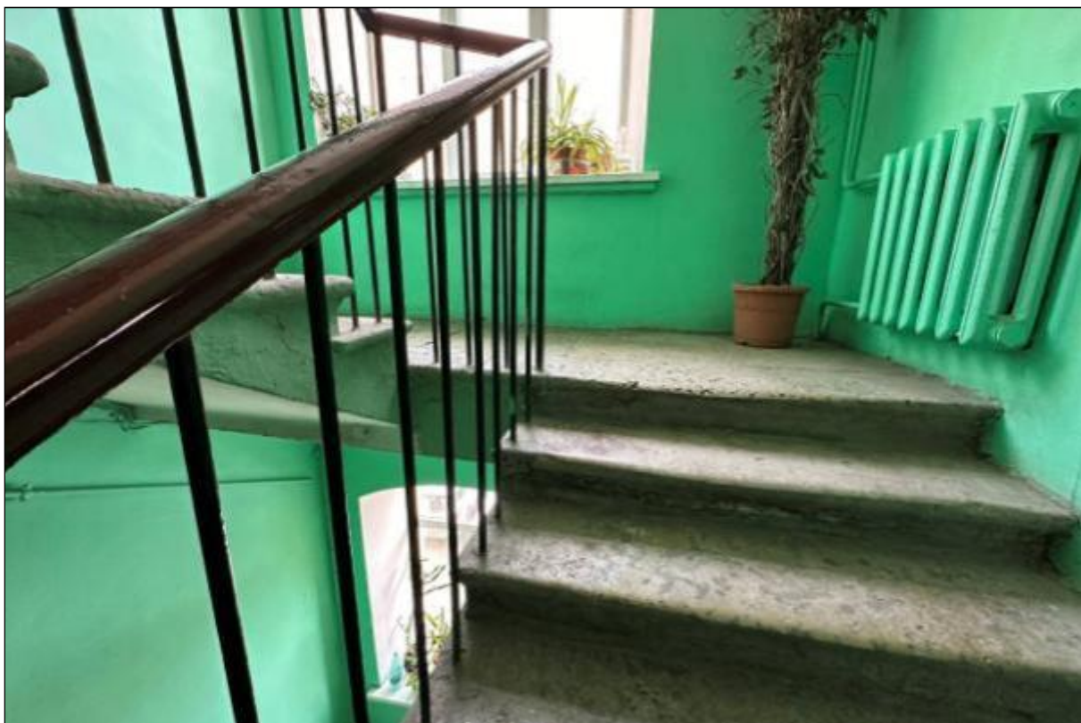
172. Выявленный объект культурного наследия «Дом В.А. Квасникова». Северный дворовый флигель. Лестница ЗЛК. Междуэтажная площадка между 2-3-м этажами. Покрытие ступеней лещадной плитой. 06.02.2025 г.
