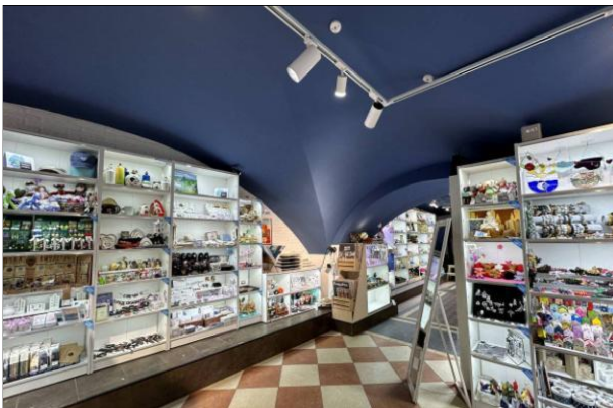
103. Выявленный объект культурного наследия «Дом В.А. Квасникова». Лицевой корпус. Цокольный этаж. Северо-западная часть помещения № 1 (1-Н). Своды коробовые с распалубками. Проем в капитальной стене между помещениями № 1 и № 2. 06.02.2025 г.
