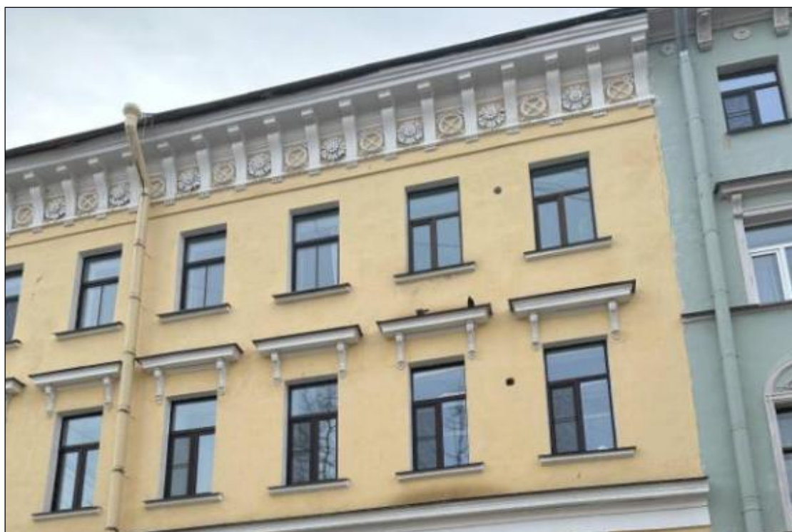
18. Выявленный объект культурного наследия «Дом В.А. Квасникова». Лицевой корпус. Северная часть лицевого фасада. Оконные проемы 2-3-го этажей. Прямые сандрики на кронштейнах оконных проемов 2-го этажа. Фрагмент венчающего антаблемента с фризом и выносным карнизом на кронштейнах. 06.02.2025 г.
