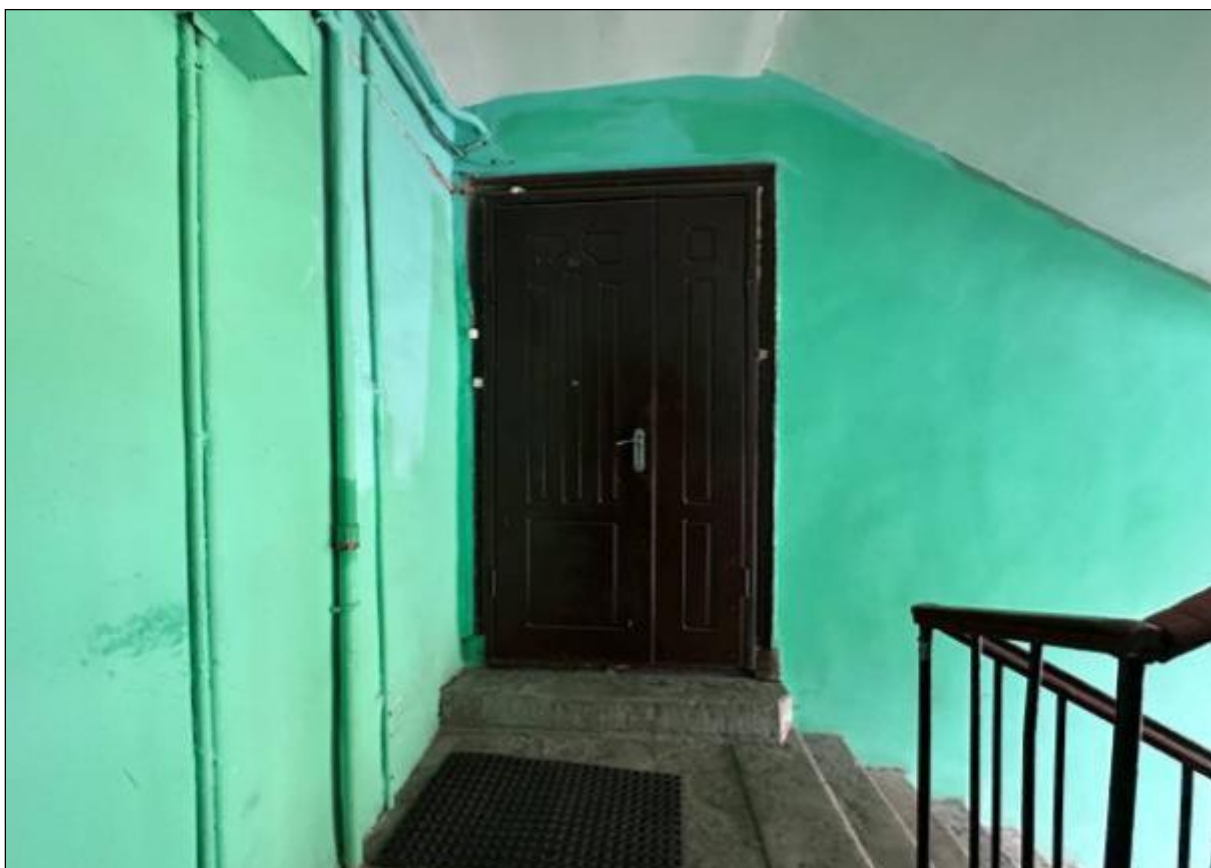
177. Выявленный объект культурного наследия «Дом В.А. Квасникова». Северный дворовый флигель. Лестница ЗЛК. Площадка 3-го этажа. Вход в квартиру № 10. 06.02.2025 г.
