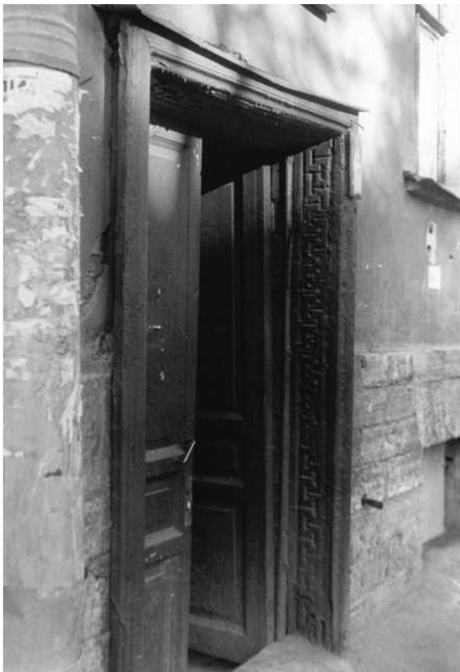
Илл. 71. 7-я линия Васильевского острова, 28. 1998 г. Дом А.В. Квасникова. Лицевой фасад. Парадный вход. URL: https://pastvu.com/p/1189665
