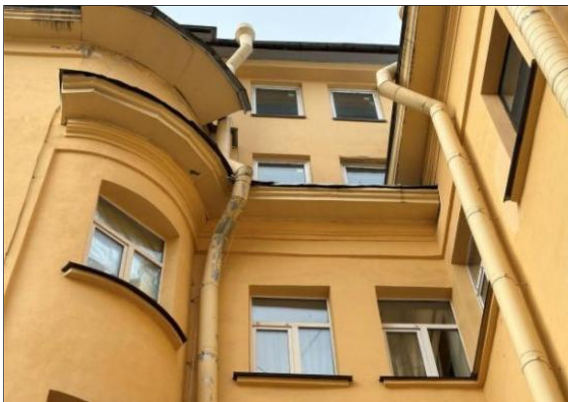
73. Выявленный объект культурного наследия «Дом В.А. Квасникова». Северный дворовый флигель. Восточная часть южного фасада. Оконные проемы 4-го и мансардного этажей. Фрагмент венчающего антаблемента с гладким фризом и выносным профилированным карнизом. 06.02.2025
