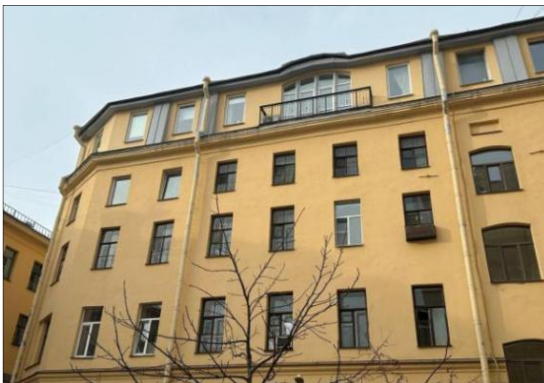
78. Выявленный объект культурного наследия «Дом В.А. Квасникова». Северный дворовый флигель. Западная часть южного фасада. Оконные проемы 3-4-го и мансардного этажей. Фрагмент венчающего антаблемента с гладким фризом и выносным профилированным карнизом. 06.02.2025 г.
