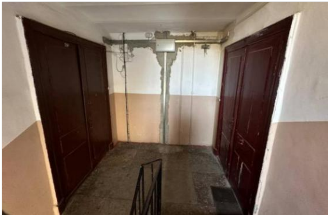
203. Выявленный объект культурного наследия «Дом В.А. Квасникова». Западный дворовый флигель. Лестница 4ЛК. Площадка 3-го этажа. Вид с междуэтажной площадки между 3-4-м этажами. 06.02.2025 г.
