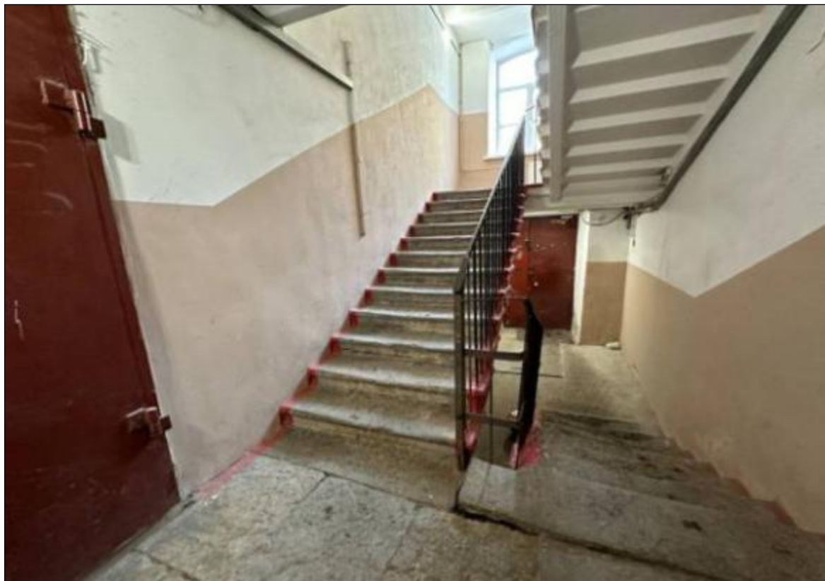
189. Выявленный объект культурного наследия «Дом В.А. Квасникова». Западный дворовый флигель. Лестница 4ЛК. Лестничные марши 1-2-го этажей. 06.02.2025 г.
