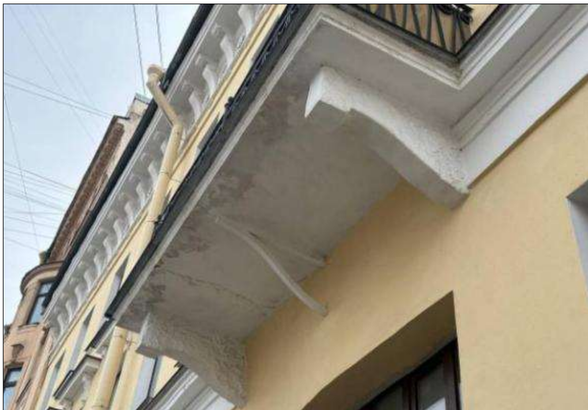
31. Выявленный объект культурного наследия «Дом В.А. Квасникова». Лицевой корпус. Центральная часть лицевого фасада. Оштукатуренные кронштейны балкона. 06.02.2025 г.
