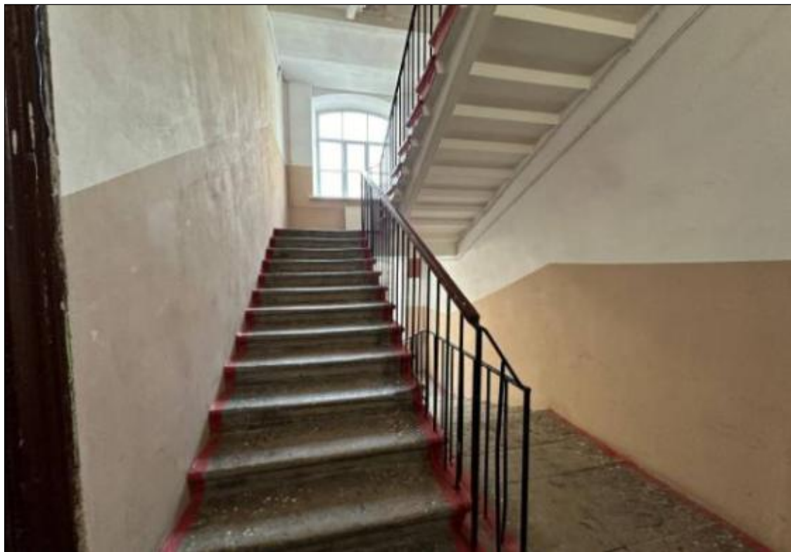
201. Выявленный объект культурного наследия «Дом В.А. Квасникова». Западный дворовый флигель. Лестница 4ЛК. Лестничные марши 2-3-го этажей. Вид с площадки 2-го этажа. 06.02.2025 г.
