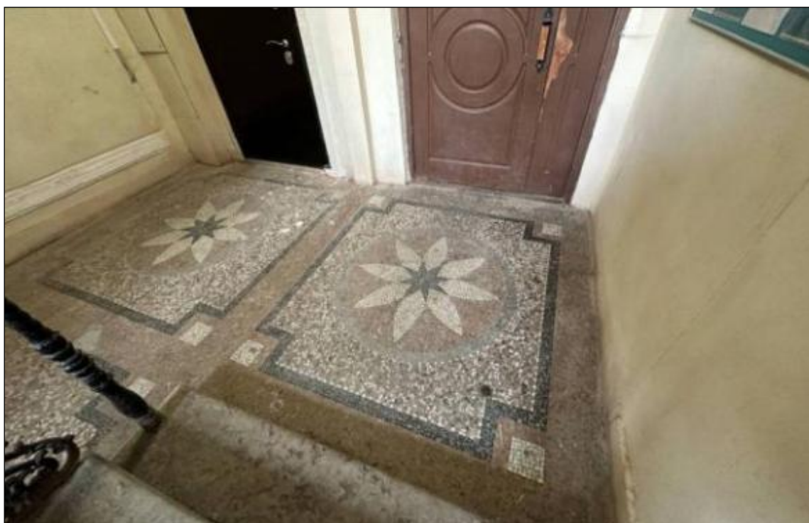
123. Выявленный объект культурного наследия «Дом В.А. Квасникова». Лицевой корпус. Площадка 1-го этажа парадной лестницы (1ЛК). Покры́тие пло́щадки – терра́ццо с расте́льным орна́ментом. 06.02.2025 г.
