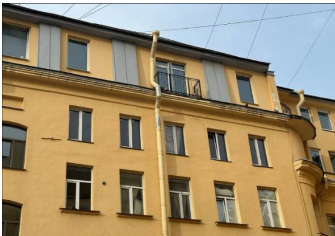
72. Выявленный объект культурного наследия «Дом В.А. Квасникова». Северный дворовый флигель. Восточная часть южного фасада. Оконные проемы 3-4-го и мансардного этажей. Фрагмент венчающего антаблемента с гладким фризом и выносным профилированным карнизом. 06.02.2025
