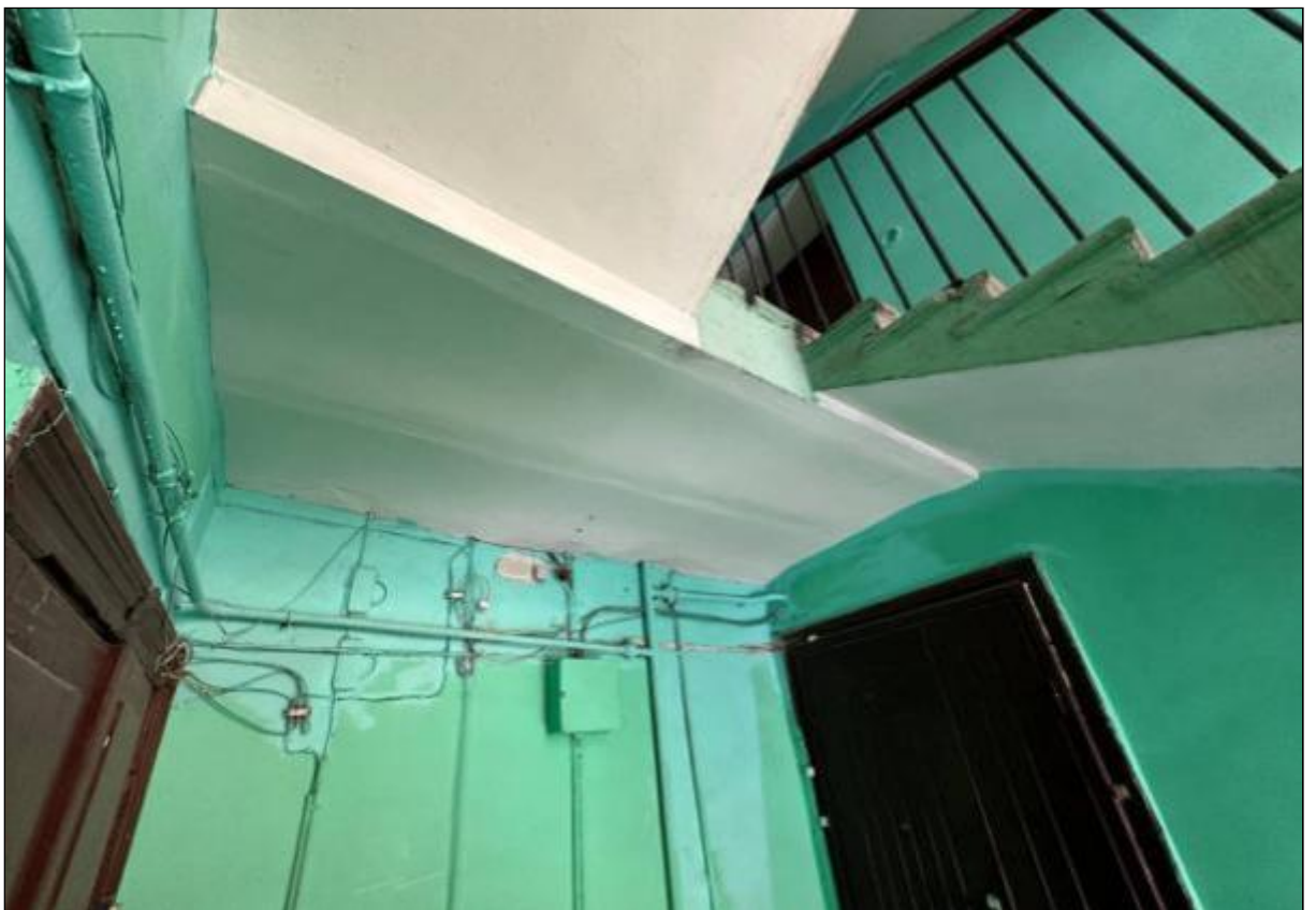
176. Выявленный объект культурного наследия «Дом В.А. Квасникова». Северный дворовый флигель. Лестница 3ЛК. Площадка 3-го этажа. Перекрытие над площадкой. 06.02.2025 г.
