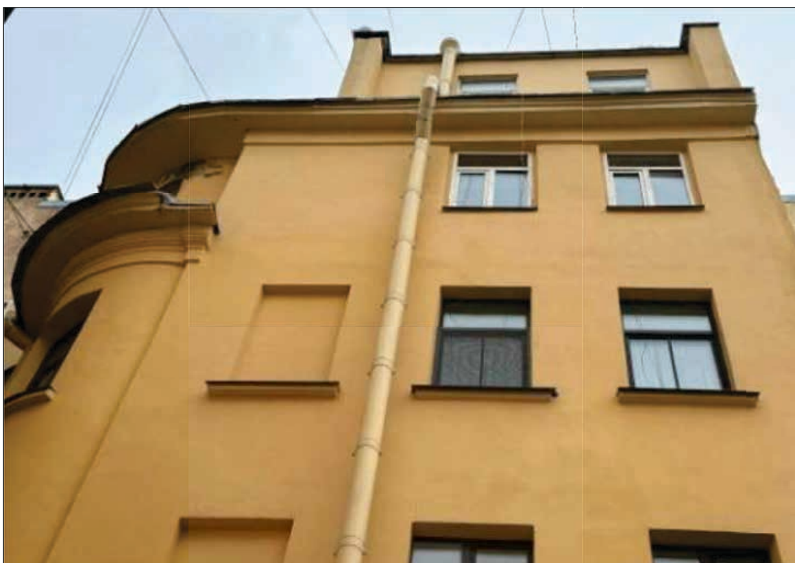
62. Выявленный объект культурного наследия «Дом В.А. Квасникова». Южный дворовый флигель. Северный фасад. Венчающий антаблемент с гладким фризом и выносным профилированным карнизом. 06.02.2025 г.
