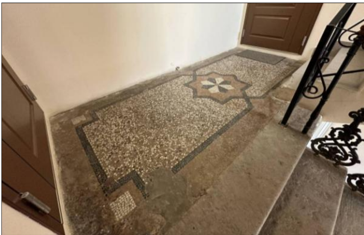
139. Выявленный объект культурного наследия «Дом В.А. Квасникова». Лицевой корпус. Площадка 3-го этажа парадной лестницы (1ЛК). Покрытие площадки – терраццо с геометрическим рисунком. 06.02.2025 г.
