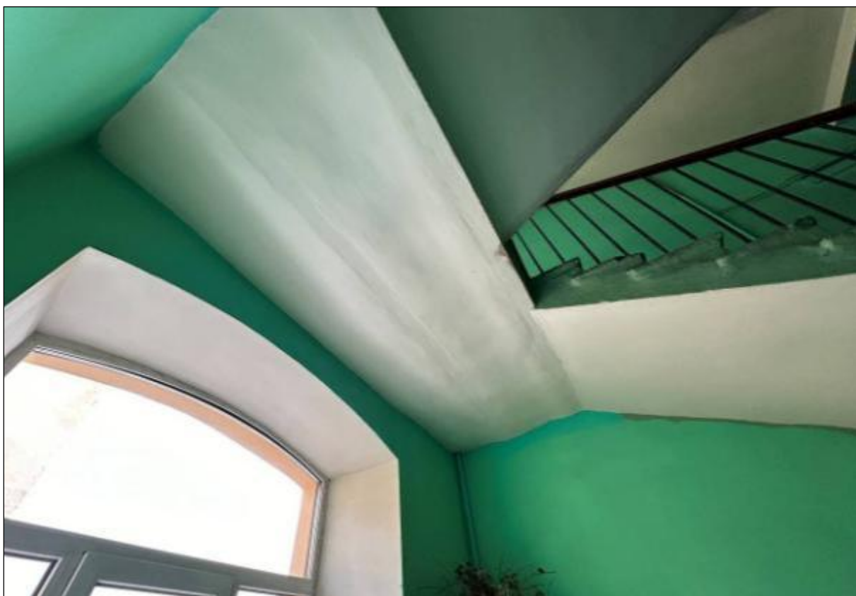
173. Выявленный объект культурного наследия «Дом В.А. Квасникова». Северный дворовый флигель. Лестница ЗЛК. Междуэтажная площадка между 2-3-м этажами. Перекрытие над площадкой. 06.02.2025 г.
