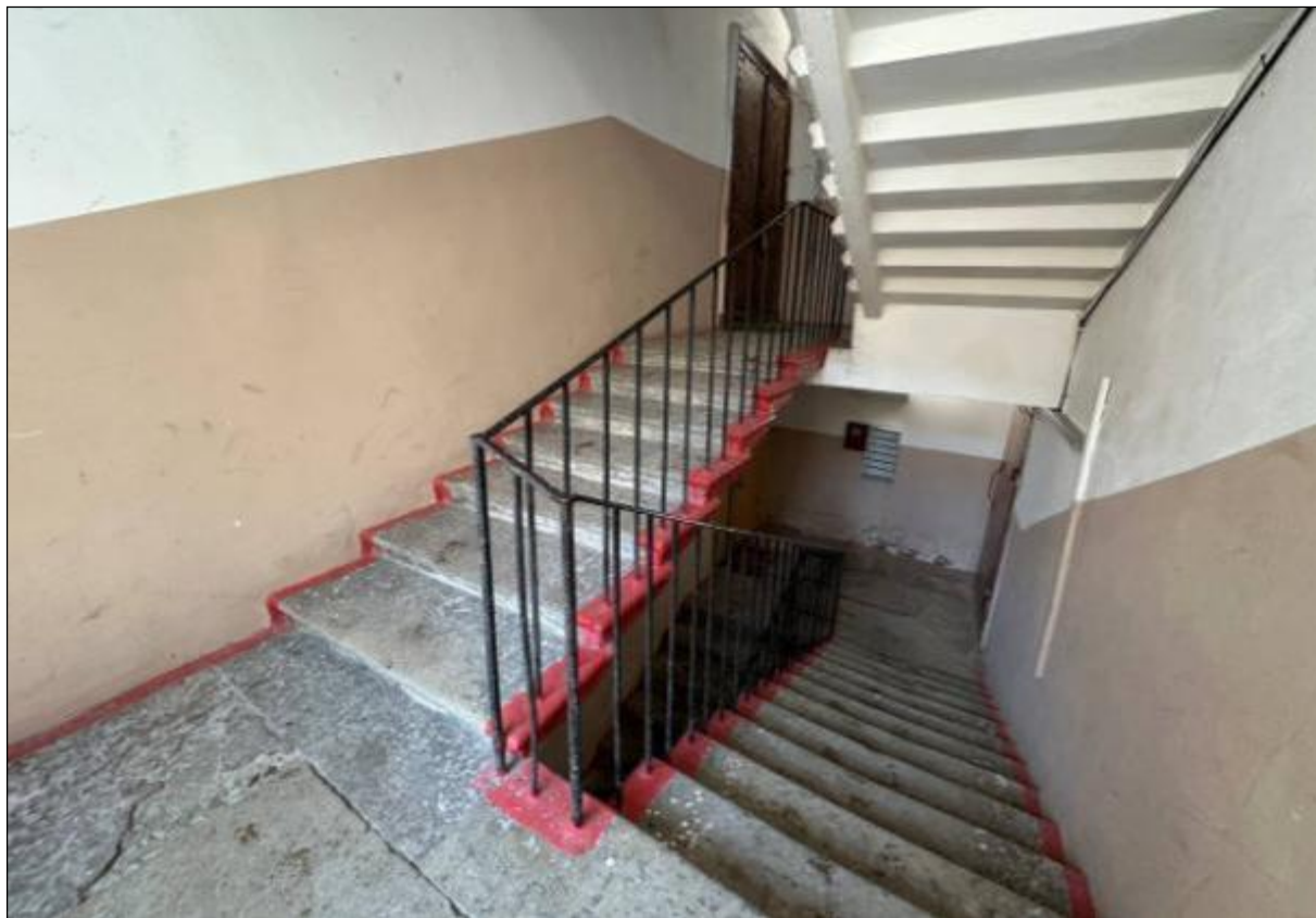
195. Выявленный объект культурного наследия «Дом В.А. Квасникова». Западный дворовый флигель. Лестница 4ЛК. Лестничные марши 1-2-го этажей. Вид с междуэтажной площадки между 1-2-м этажами. 06.02.2025 г.
