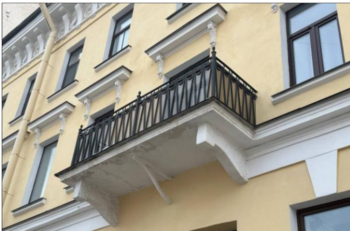
30. Выявленный объект культурного наследия «Дом В.А. Квасникова». Лицевой корпус. Центральная часть лицевого фасада. Балкон на оштукатуренных кронштейнах в уровне 2-го этажа. 06.02.2025 г.
