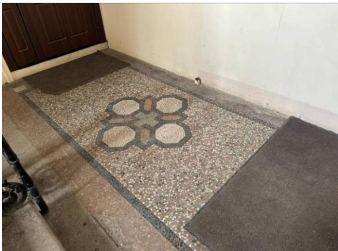
131. Выявленный объект культурного наследия «Дом В.А. Квасникова». Лицевой корпус. Парадная лестница (1ЛК). Площадка 2-го этажа. Покрытие площадки – терраццо с геометрическим рисунком. 06.02.2025 г.
