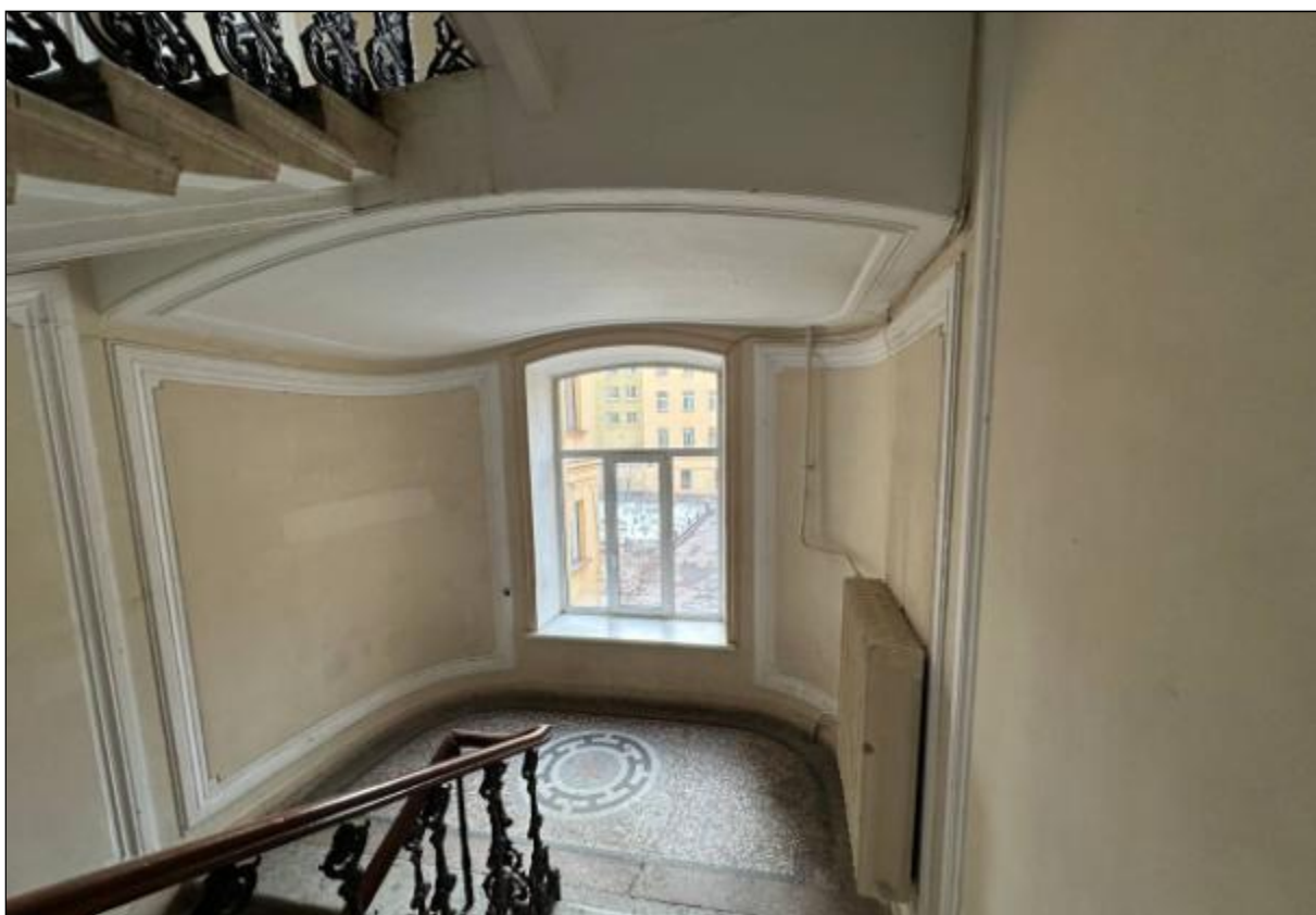
125. Выявленный объект культурного наследия «Дом В.А. Квасникова». Лицевой корпус. Парадная лестница (1ЛК). Междуэтажная площадка 1-2-го этажей. Оформление стен и перекрытия над площадкой филёнками. 06.02.2025 г.
