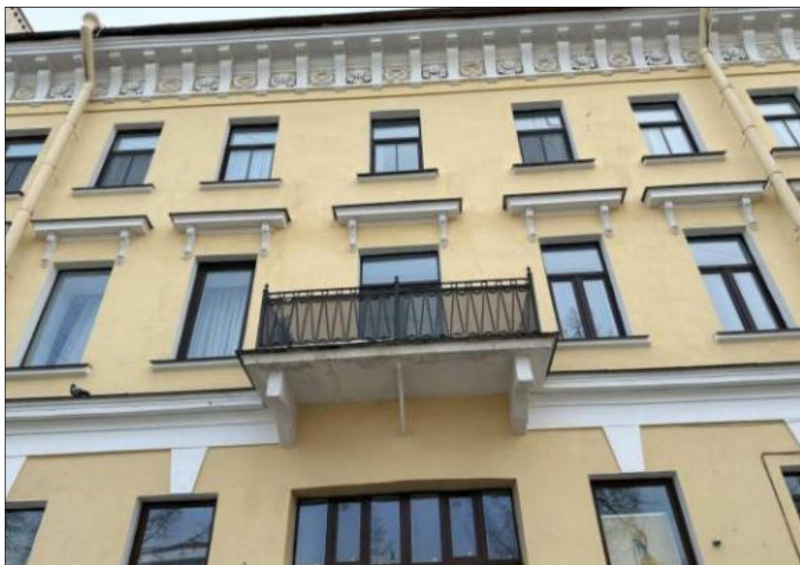
29. Выявленный объект культурного наследия «Дом В.А. Квасникова». Лицевой корпус. Центральная часть лицевого фасада. Балкон на оштукатуренных кронштейнах в уровне 2-го этажа. Оконные проемы 2-го и 3-го этажей. 06.02.2025 г.
