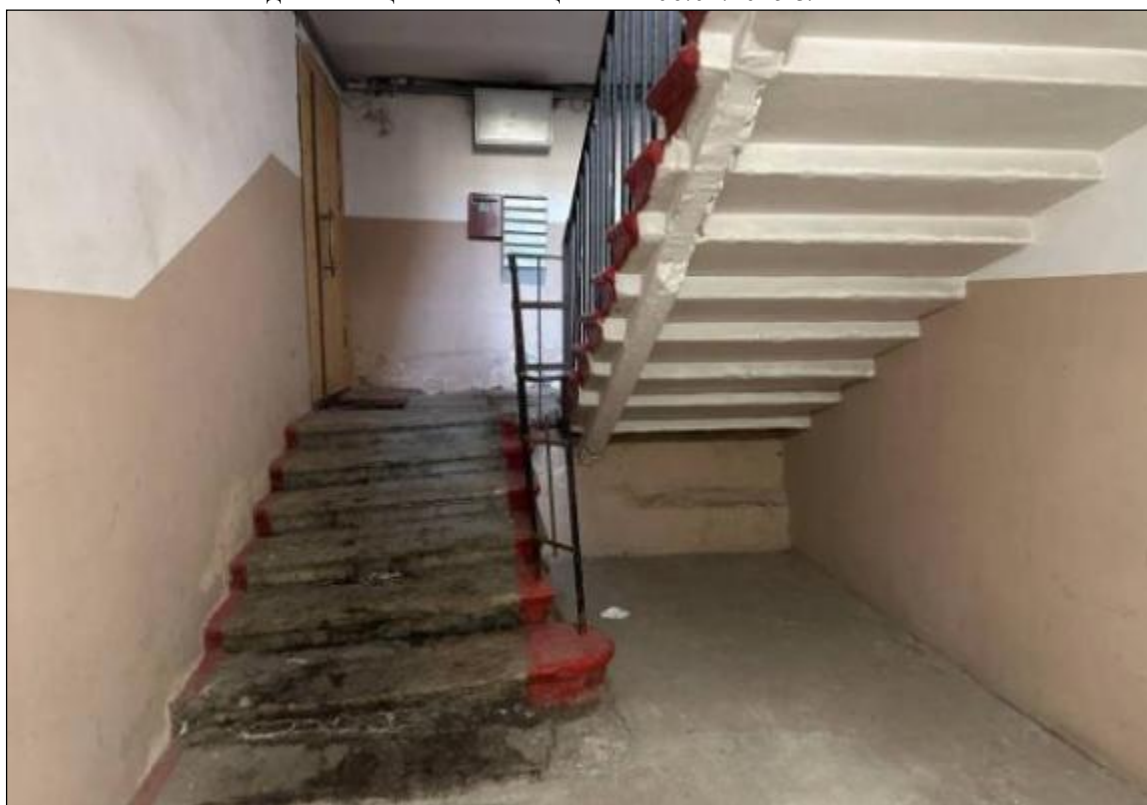
188. Выявленный объект культурного наследия «Дом В.А. Квасникова». Западный дворовый флигель. Нижняя площадка лестницы 4ЛК. Лестничный марш 1-го этажа. 06.02.2025 г.
