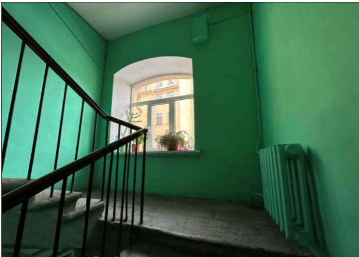
161. Выявленный объект культурного наследия «Дом В.А. Квасникова». Северный дворовый флигель. Лестница ЗЛК. Междуэтажная площадка между 1-2-м этажами. 06.02.2025 г.
