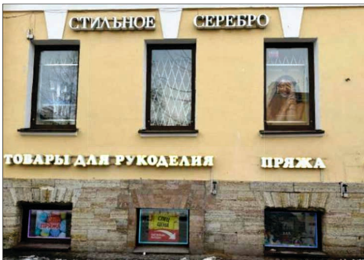
17. Выявленный объект культурного наследия «Дом В.А. Квасникова». Лицевой корпус. Северная часть лицевого фасада. Оконные проемы цокольного и 1-го этажей. Отделка цоколя известняковой плитой. 06.02.2025 г.
