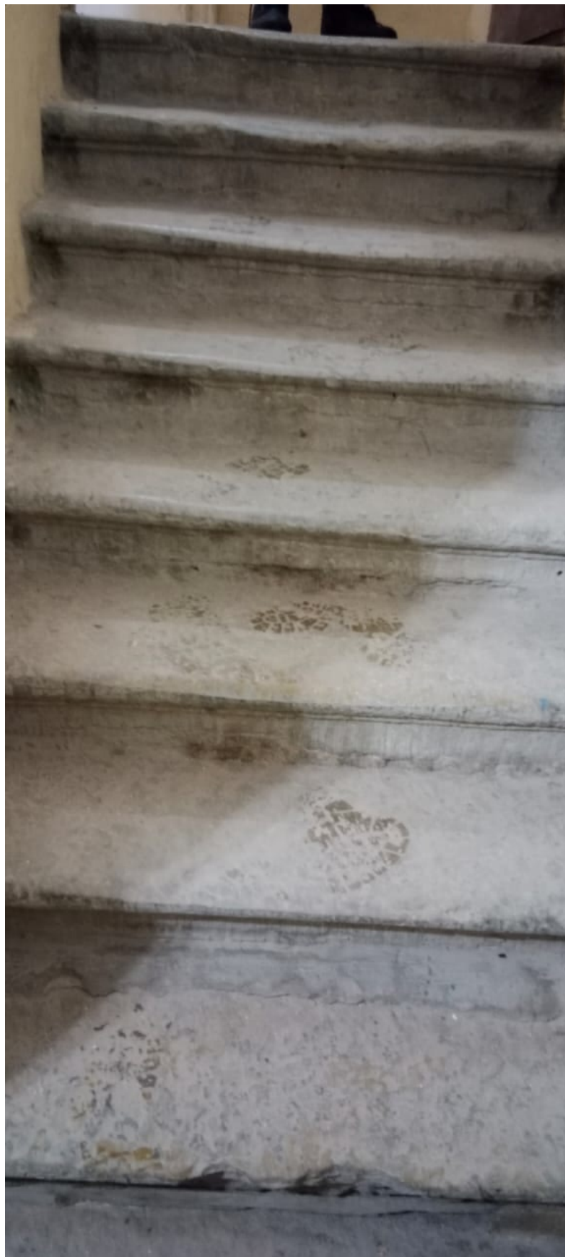
59в Выявленный объект культурного наследия «Дом В.А. Квасникова». Лестничная клетка Л-2. Лестничный марш. 02.04.2025 г.
