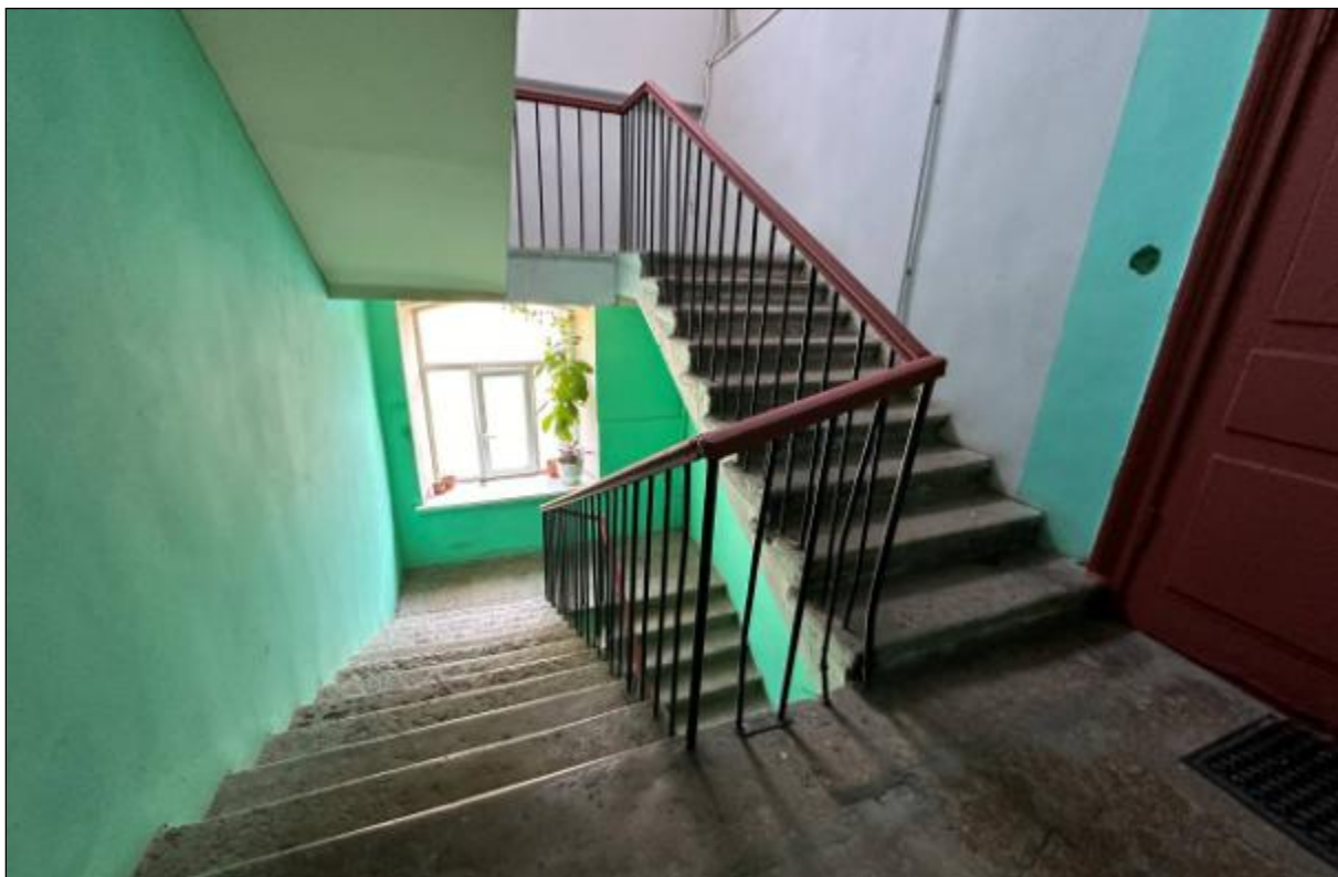
181. Выявленный объект культурного наследия «Дом В.А. Квасникова». Северный дворовый флигель. Лестница ЗЛК. Лестничные марши 4-го и мансардного этажей. Вид с площадки 4-го этажа. 06.02.2025 г.
