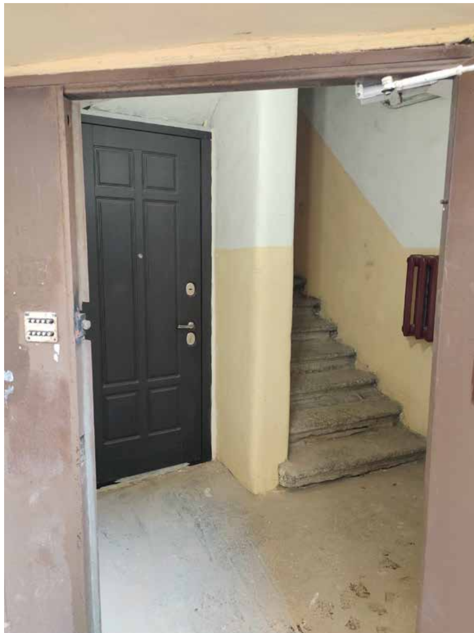
59а 33 . Выявленный объект культурного наследия «Дом В.А. Квасникова». Лестничная клетка Л-2. Вид от входа. 02.04.2025 г.
