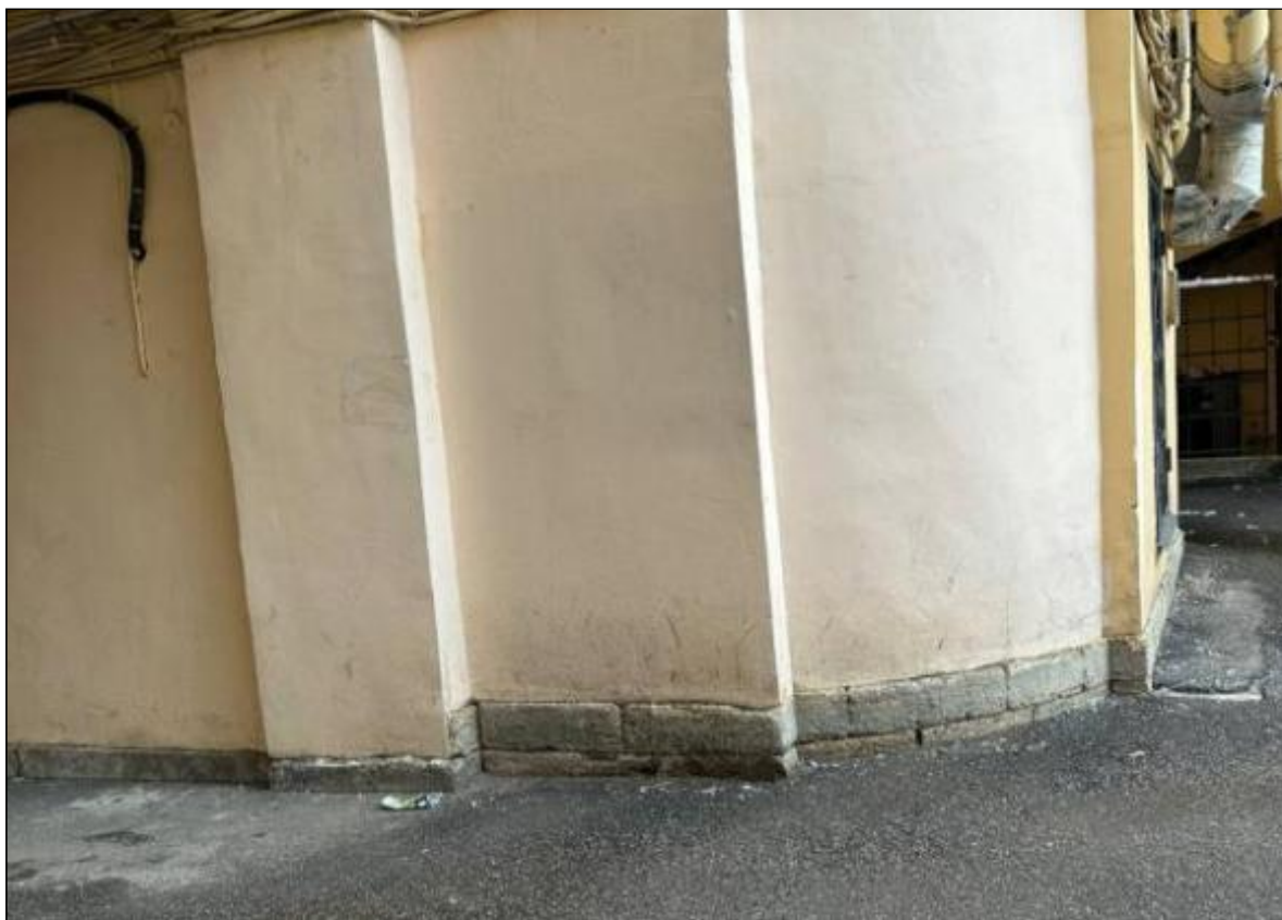
47. Выявленный объект культурного наследия «Дом В.А. Квасникова». Лицевой корпус. Дворовый фасад. Ризалит парадной лестницы. Вид с запада. Отделка цоколя известняковой плитой. 06.02.2025 г.
