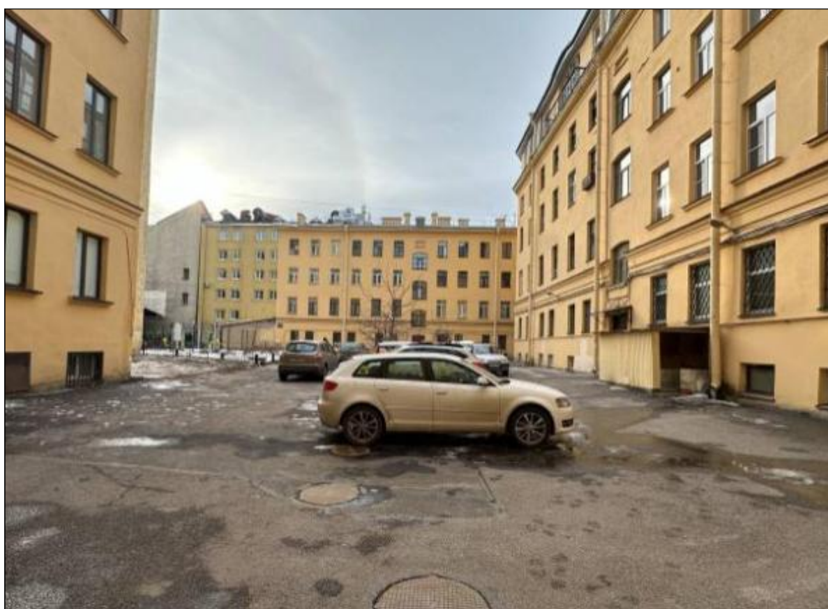
5. Территория выявленного объекта культурного наследия «Дом В.А. Квасникова». Вид с востока на западный дворовый флигель. 06.02.2025 г.
