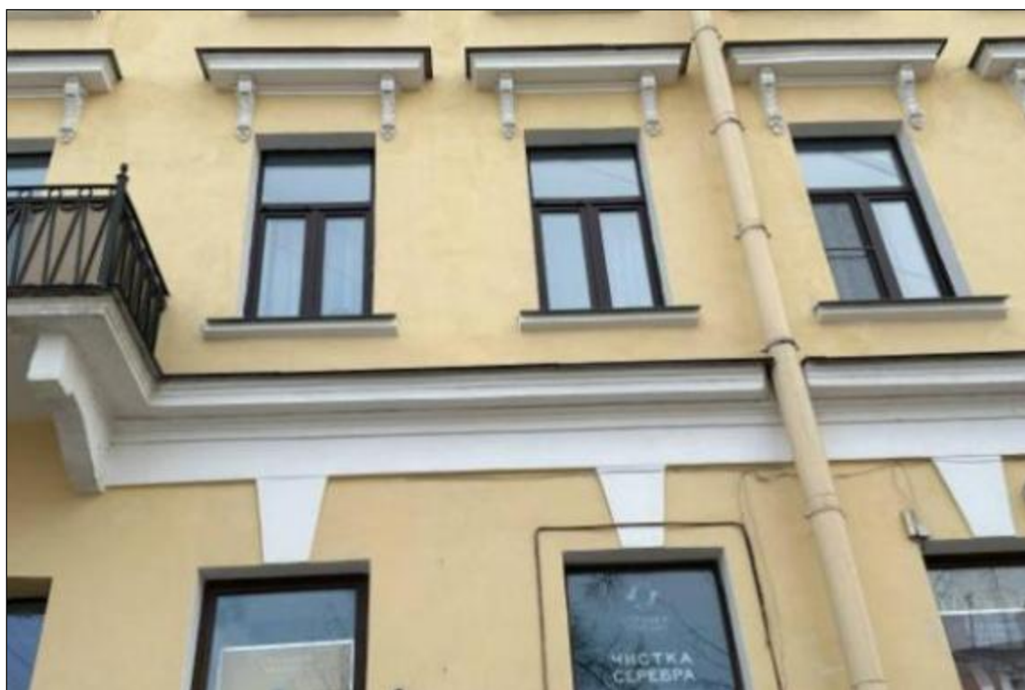
20. Выявленный объект культурного наследия «Дом В.А. Квасникова». Лицевой корпус. Северная часть лицевого фасада. Фрагмент межэтажного антаблемента между 1-2-м этажами. Прямые сандрики на кронштейнах оконных проемов 2-го этажа. Замковые камни оконных проемов 1-го этажа. 06.02.2025 г.
