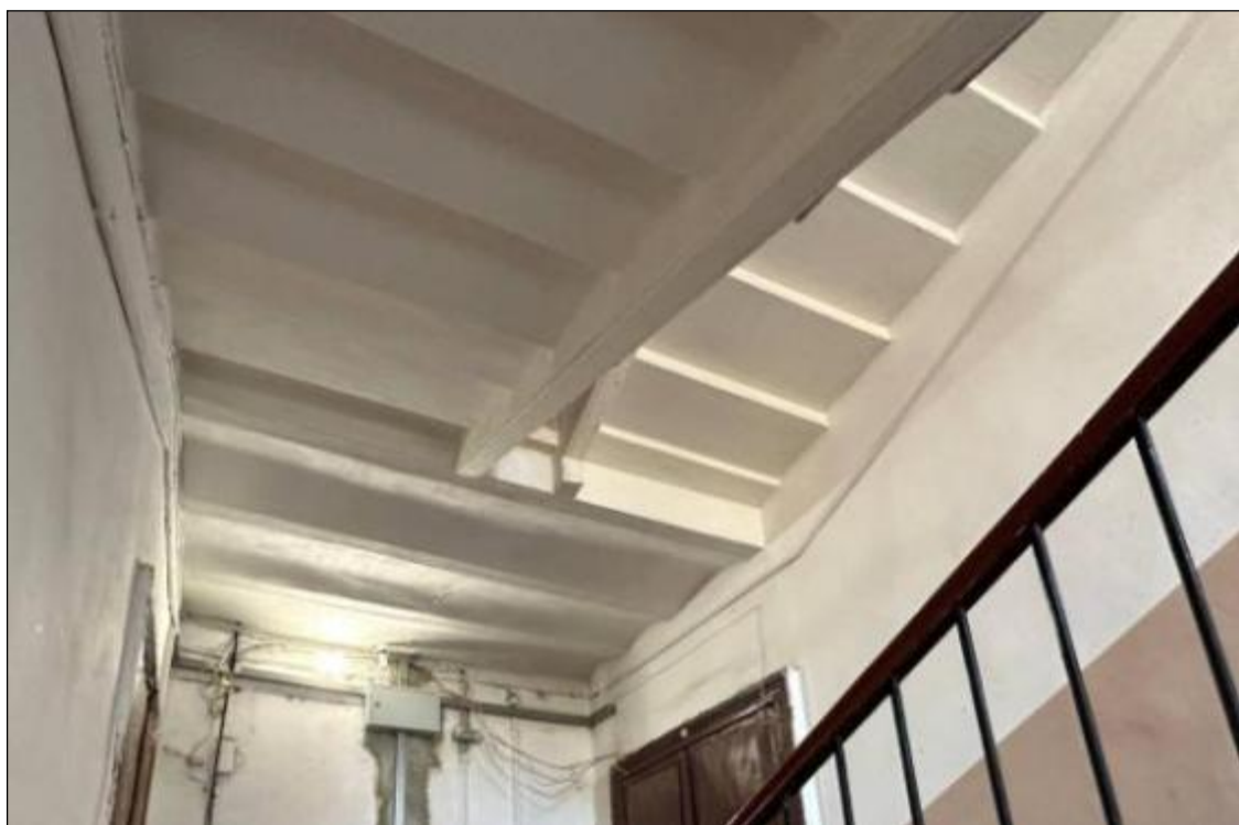
198. Выявленный объект культурного наследия «Дом В.А. Квасникова». Западный дворовый флигель. Лестница 4ЛК. Площадка 2-го этажа. Перекрытие над площадкой. 06.02.2025 г.
