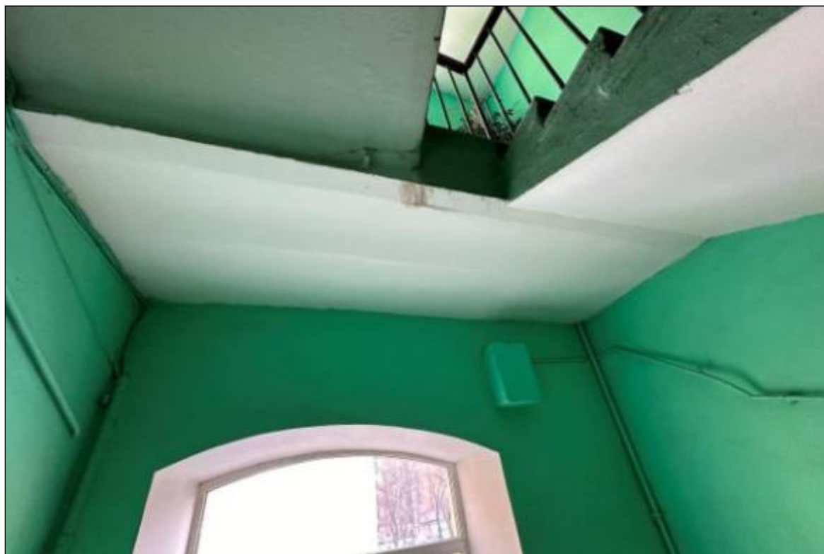
162. Выявленный объект культурного наследия «Дом В.А. Квасникова». Северный дворовый флигель. Лестница ЗЛК. Междуэтажная площадка между 1-2-м этажами. Перекрытие над площадкой. 06.02.2025 г.
