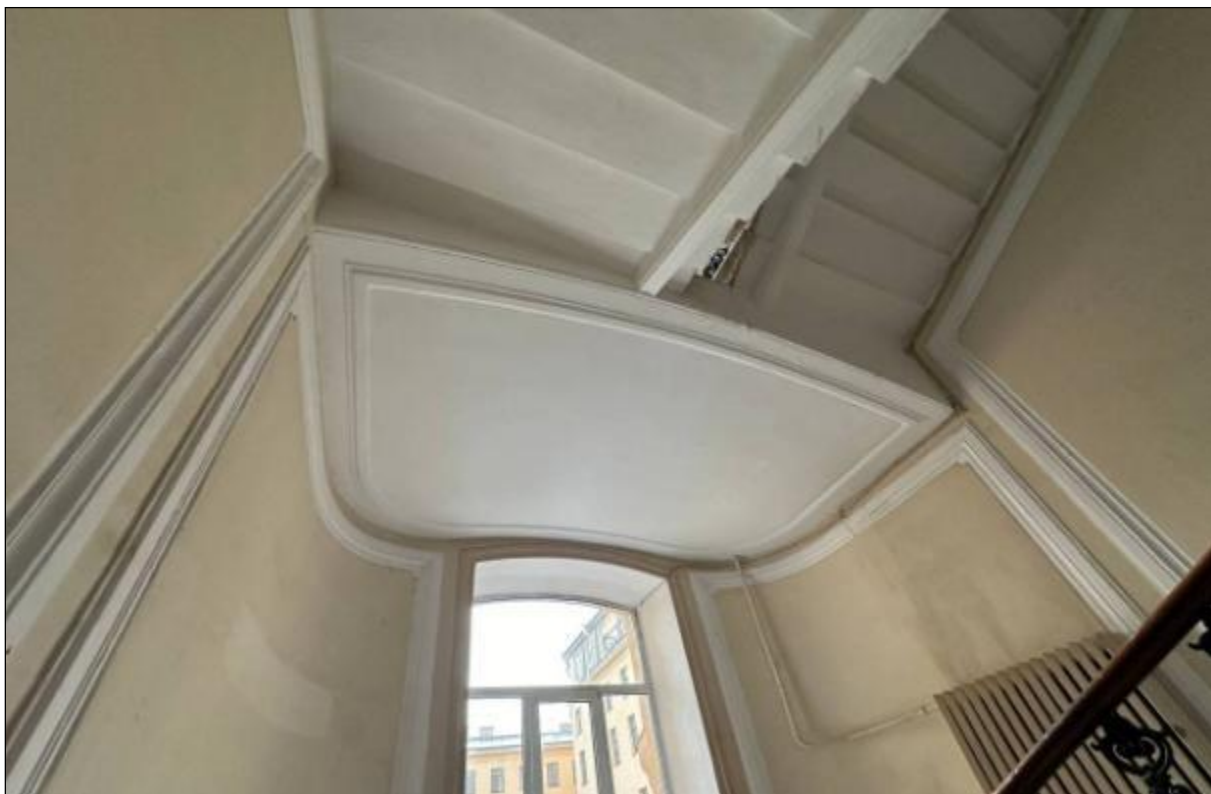
126. Выявленный объект культурного наследия «Дом В.А. Квасникова». Лицевой корпус. Парадная лестница (1ЛК). Междуэтажная площадка 1-2-го этажей. Оформление перекрытия над площадкой филёнками. 06.02.2025 г.
