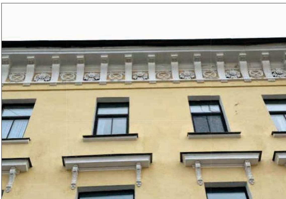
32. Выявленный объект культурного наследия «Дом В.А. Квасникова». Лицевой корпус. Центральная часть лицевого фасада. Прямые сандрики на кронштейнах оконных проемов 2-го этажа. Фрагмент венчающего антаблемента с фризом и выносным карнизом на кронштейнах. 06.02.2025 г.
