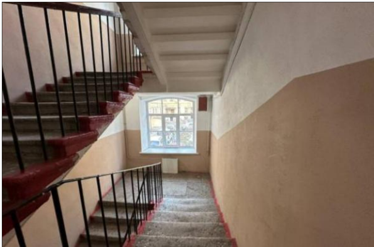
193. Выявленный объект культурного наследия «Дом В.А. Квасникова». Западный дворовый флигель. Лестница 4ЛК. Междуэтажная площадка между 1-2-м этажами. 06.02.2025 г.
