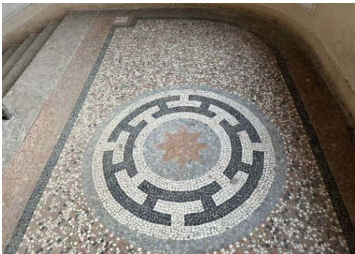
127. Выявленный объект культурного наследия «Дом В.А. Квасникова». Лицевой корпус. Парадная лестница (1ЛК). Междуэтажная площадка 1-2-го этажей. Покрытие площадки – терраццо с геометрическим рисунком. 06.02.2025 г.
