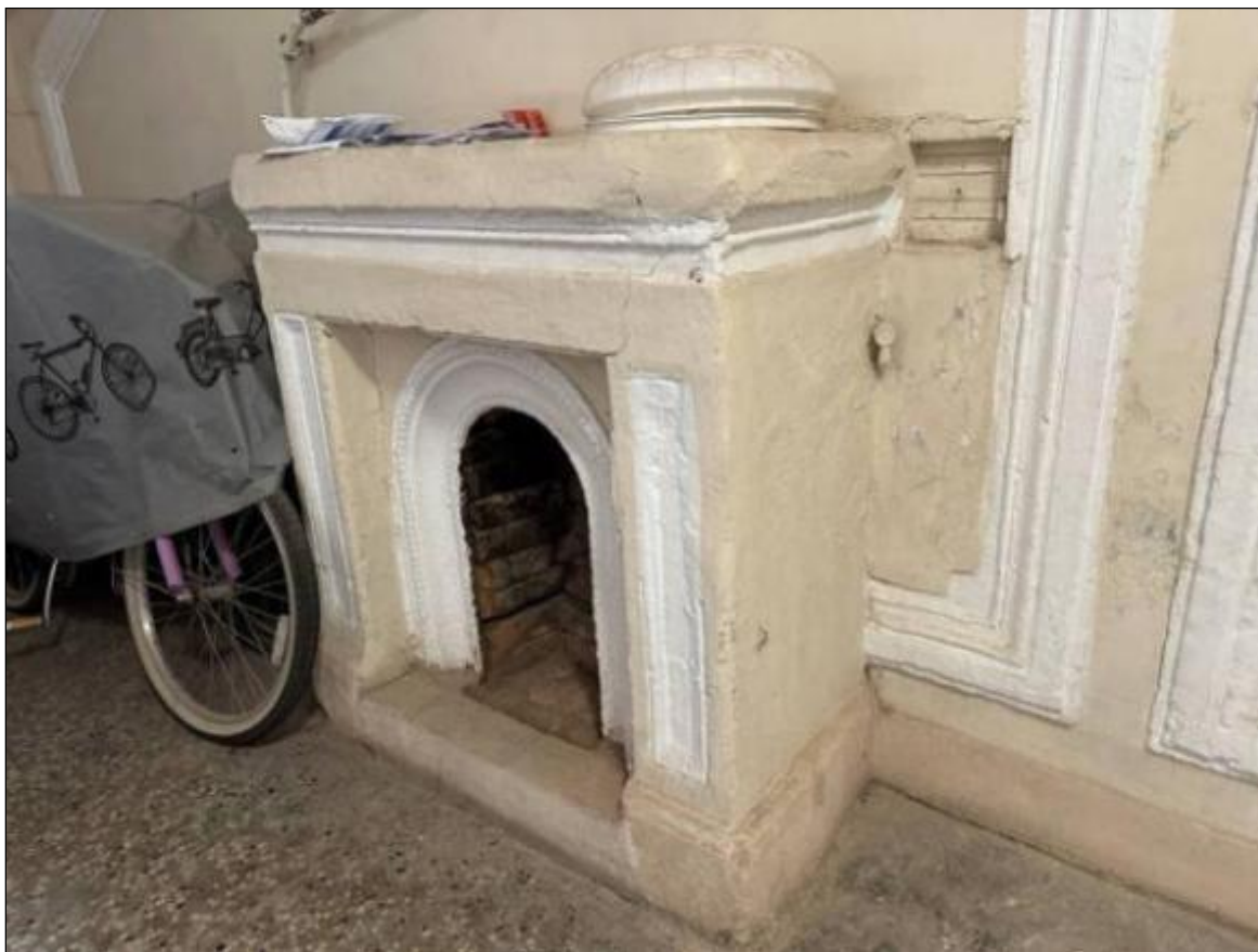
122. Выявленный объект культурного наследия «Дом В.А. Квасникова». Лицевой корпус. Площадка 1-го этажа парадной лестницы (1ЛК). Среди́стенный одноярусный ками́н. 06.02.2025 г.
