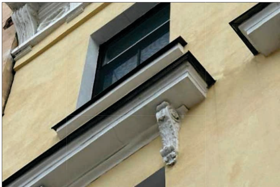
11. Выявленный объект культурного наследия «Дом В.А. Квасникова». Лицевой корпус. Лицевой фасад. Фрагмент прямого сандрика на кронштейнах оконного проема 2-го этажа. Кронштейн, декорированный акантом. 06.02.2025 г.
