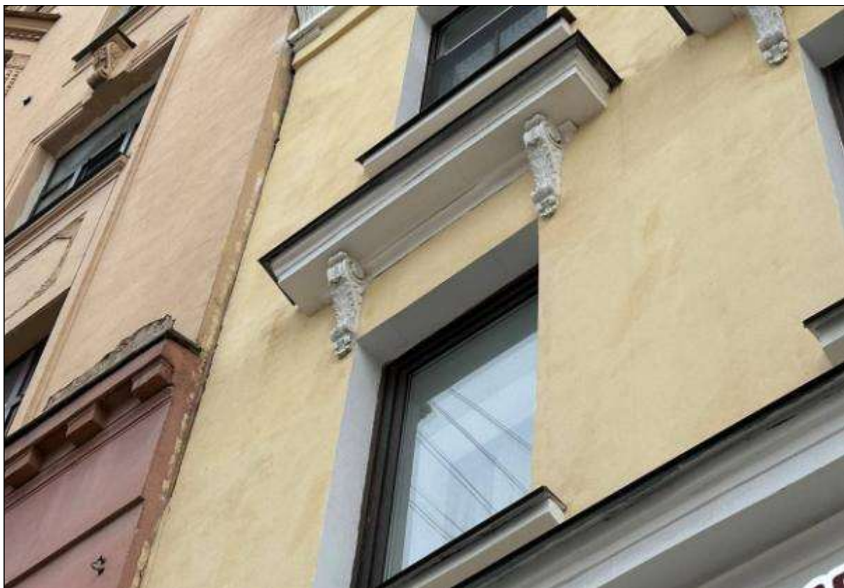
10. Выявленный объект культурного наследия «Дом В.А. Квасникова». Лицевой корпус. Лицевой фасад. Прямой сандрик на кронштейнах, декорированных акантом, оконного проема 2-го этажа. 06.02.2025 г.
