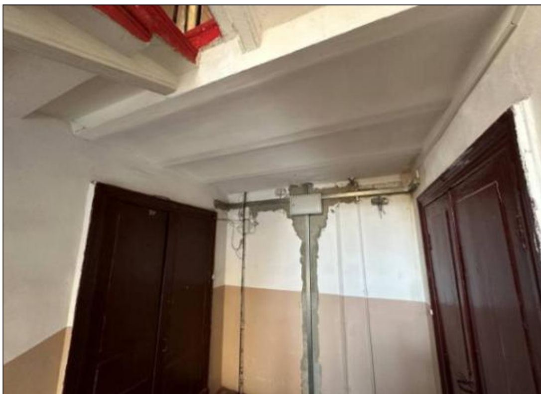
204. Выявленный объект культурного наследия «Дом В.А. Квасникова». Западный дворовый флигель. Лестница 4ЛК. Площадка 3-го этажа. Перекрытие над площадкой. 06.02.2025 г.
