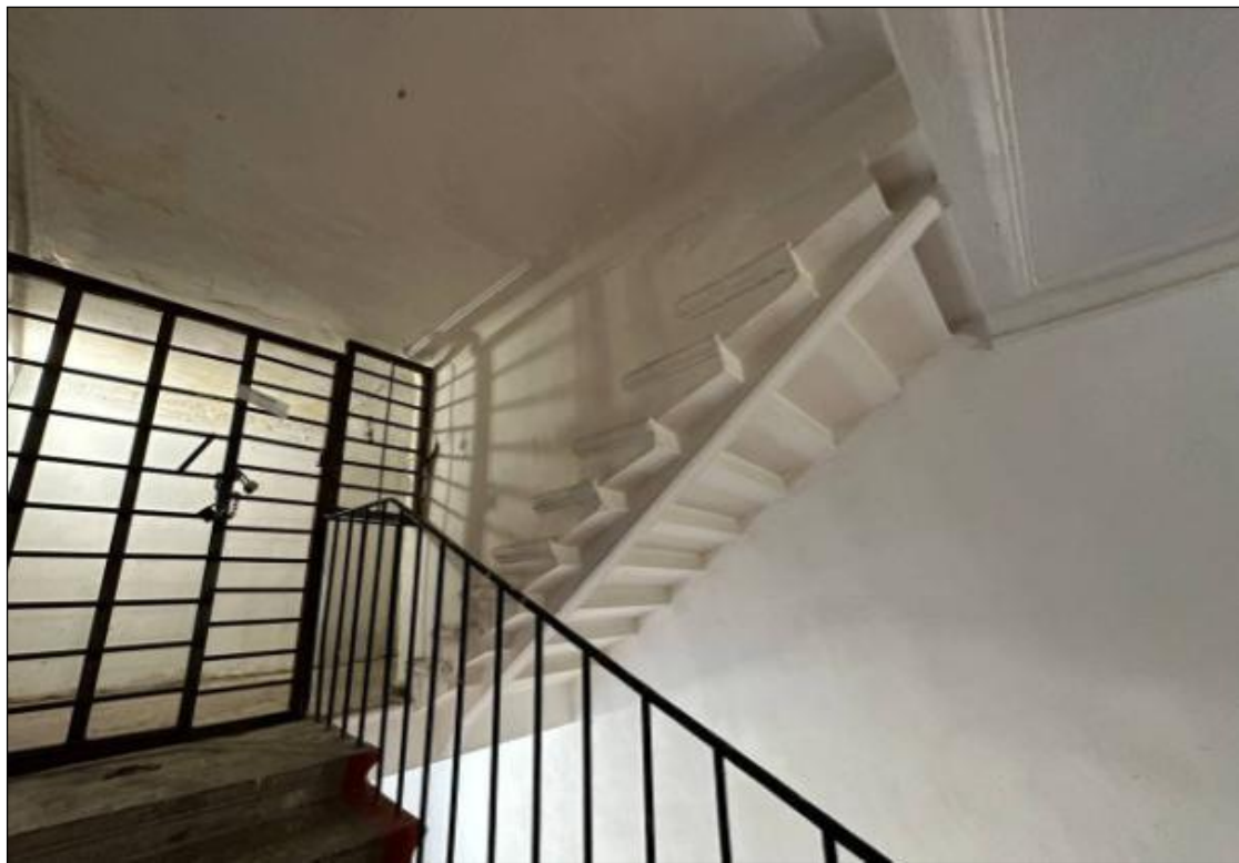
215. Выявленный объект культурного наследия «Дом В.А. Квасникова». Западный дворовый флигель. Лестница 4ЛК. Лестничный марш на чердак. 06.02.2025 г.
