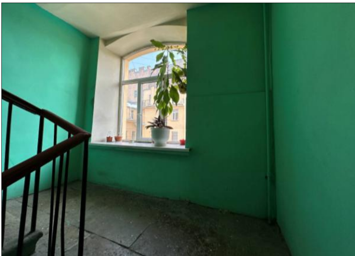
179. Выявленный объект культурного наследия «Дом В.А. Квасникова». Северный дворовый флигель. Лестница ЗЛК. Междуэтажная площадка между 3-4-м этажами. 06.02.2025 г.
