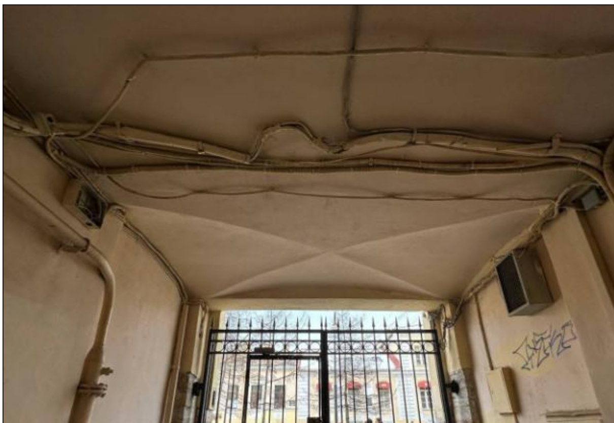
37. Выявленный объект культурного наследия «Дом В.А. Квасникова». Лицевой корпус. Пологий цилиндрический свод с распалубками перекрытия воротного проезда. 06.02.2025 г.
