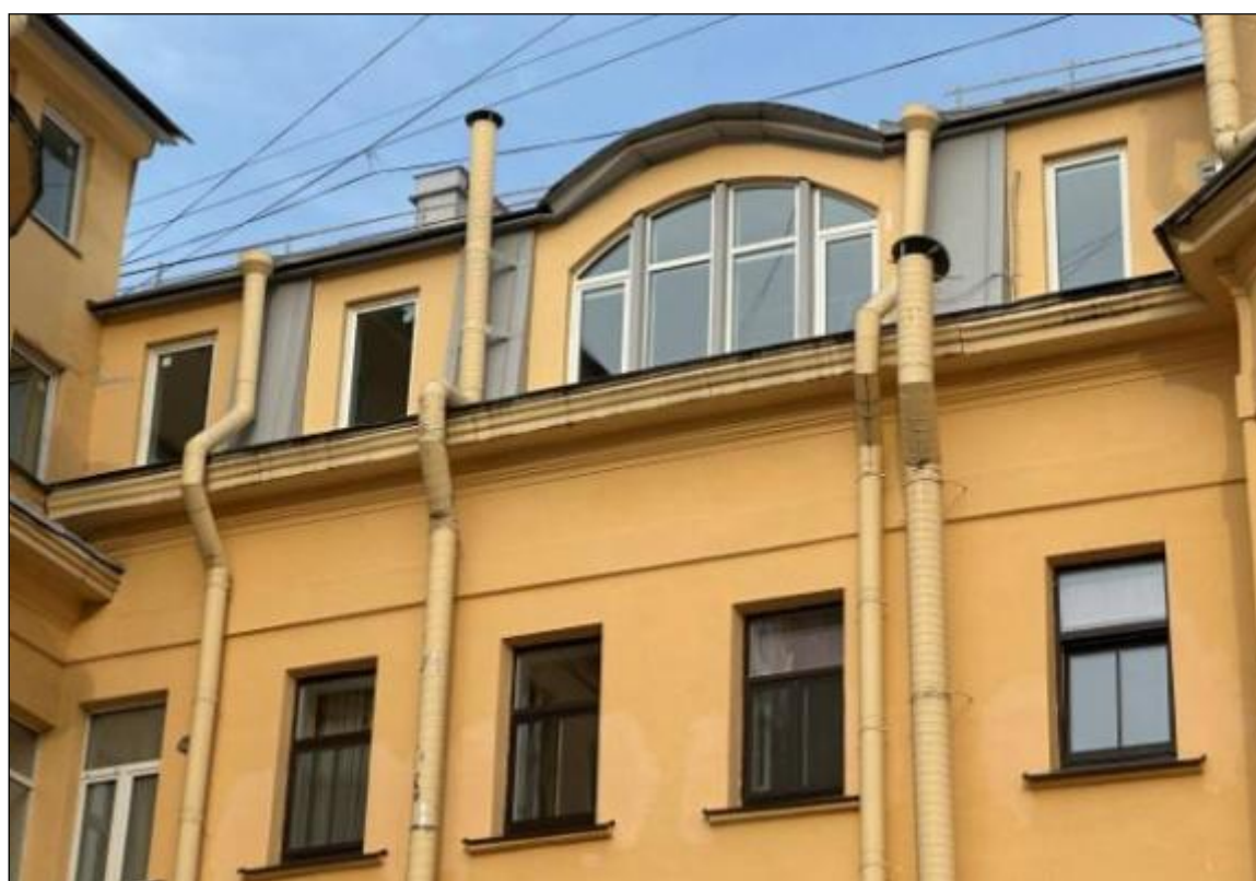
52. Выявленный объект культурного наследия «Дом В.А. Квасникова». Лицевой корпус. Северная часть дворового фасада. Оконные проемы 3-го и мансардного этажей. Венчающий антаблемент с гладким фризом и выносным профилированным карнизом. 06.02.2025
