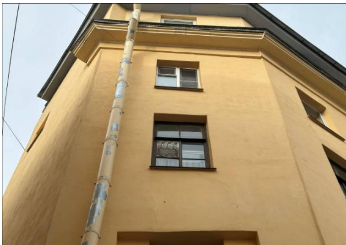
81. Выявленный объект культурного наследия «Дом В.А. Квасникова». Северный дворовый флигель. Западная часть южного фасада. Оконные проемы 3-4-го этажей. Фрагмент венчающего антаблемента с гладким фризом и выносным профилированным карнизом. 06.02.2025 г.
