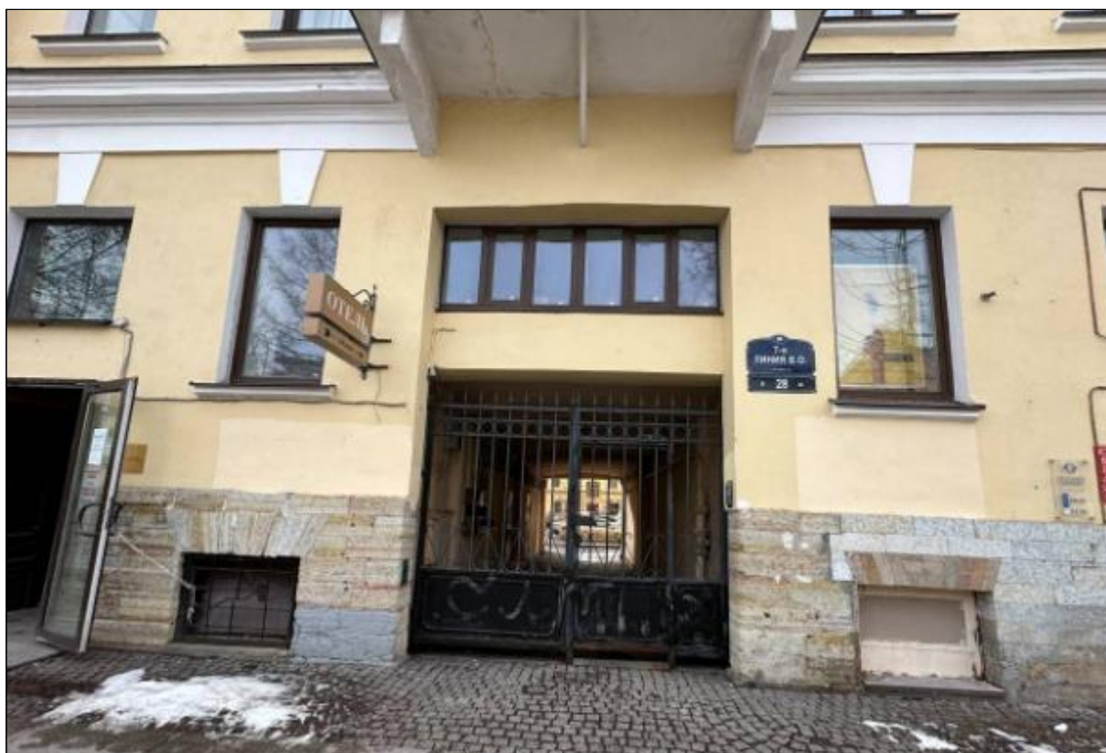
33. Выявленный объект культурного наследия «Дом В.А. Квасникова». Лицевой корпус. Центральная часть лицевого фасада. Проем воротного проезда, вписанный в прямоугольную нишу с оконным проемом антресоли над проездом. 06.02.2025 г.
