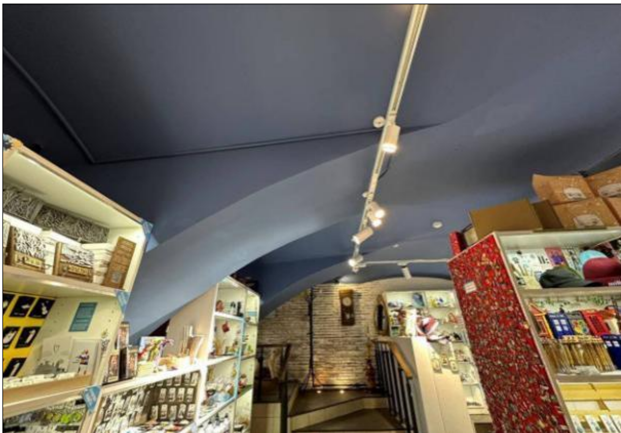
104. Выявленный объект культурного наследия «Дом В.А. Квасникова». Лицевой корпус. Цокольный этаж. Юго-западная часть помещения № 1 (1-Н). Своды коробовые с распалубками. 06.02.2025 г.
