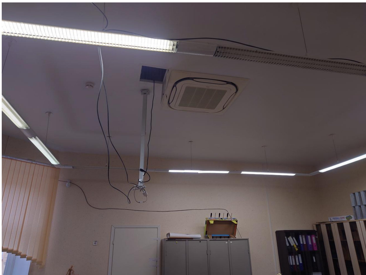
10. Пом. 21, вид на место предполагаемой установки кондиционера.
