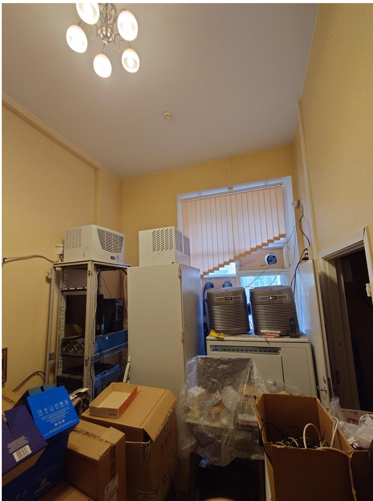
9. Пом. 20, вид на место предполагаемой установки кондиционера.
