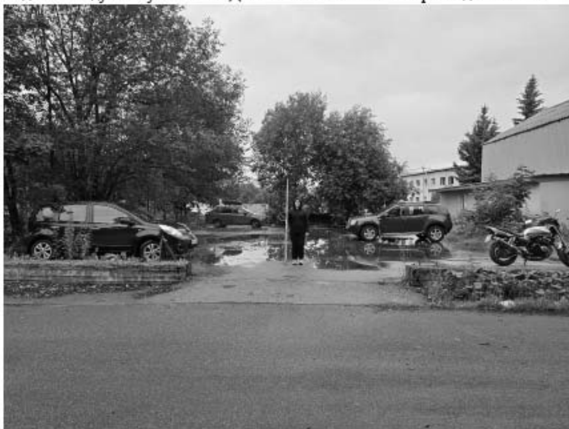
Ил. 30. Санкт-Петербург, Шкиперский проток д. 14. Точка Ф 14. Вид на обследуемый участок с Ю. Для масштаба использована рейка длиной 2 м.
