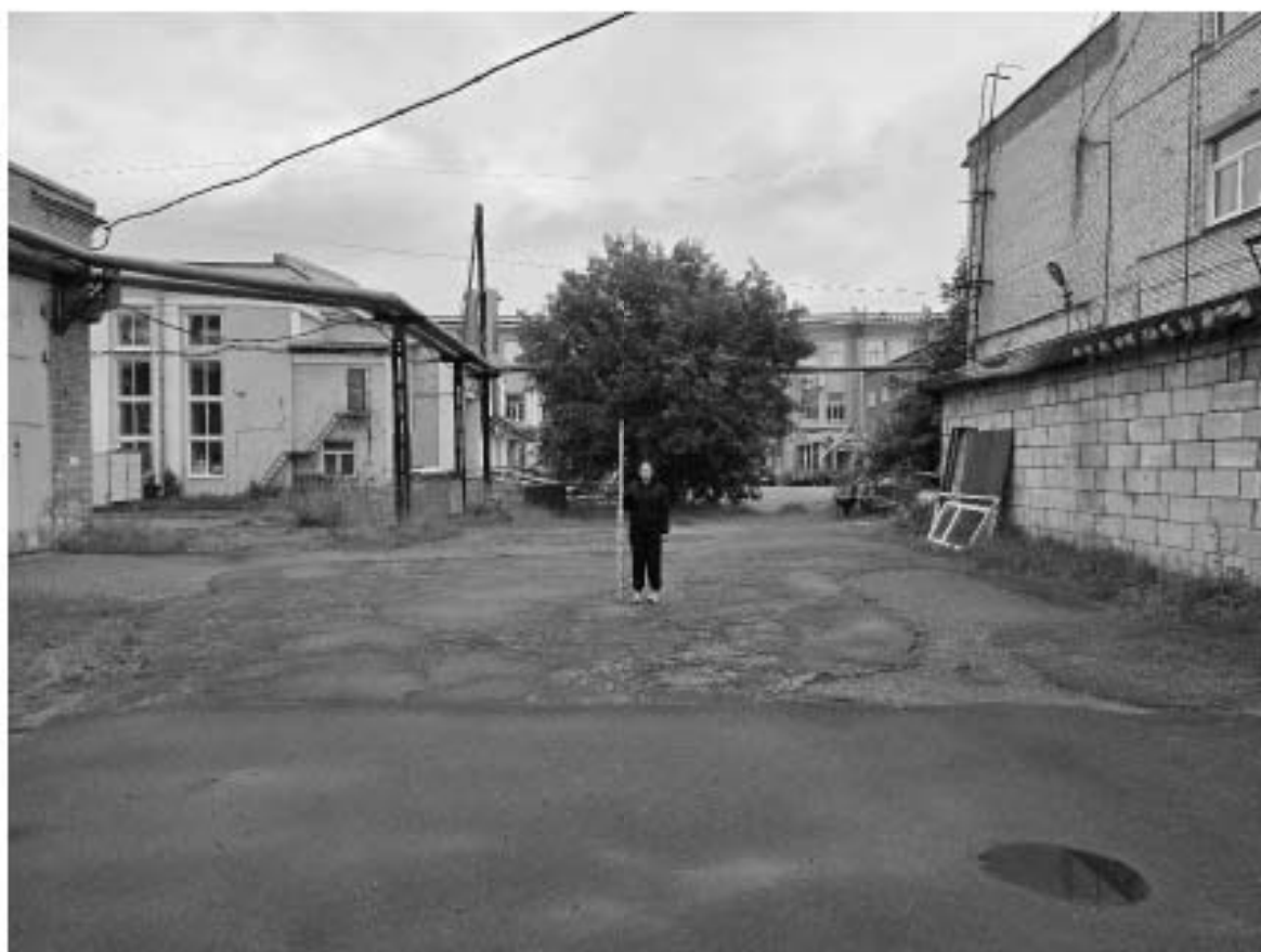
Ил. 25. Санкт-Петербург, Шкиперский проток д. 14. Точка Ф 9. Вид на обследуемый участок с З. Для масштаба использована рейка длиной 2 м.
