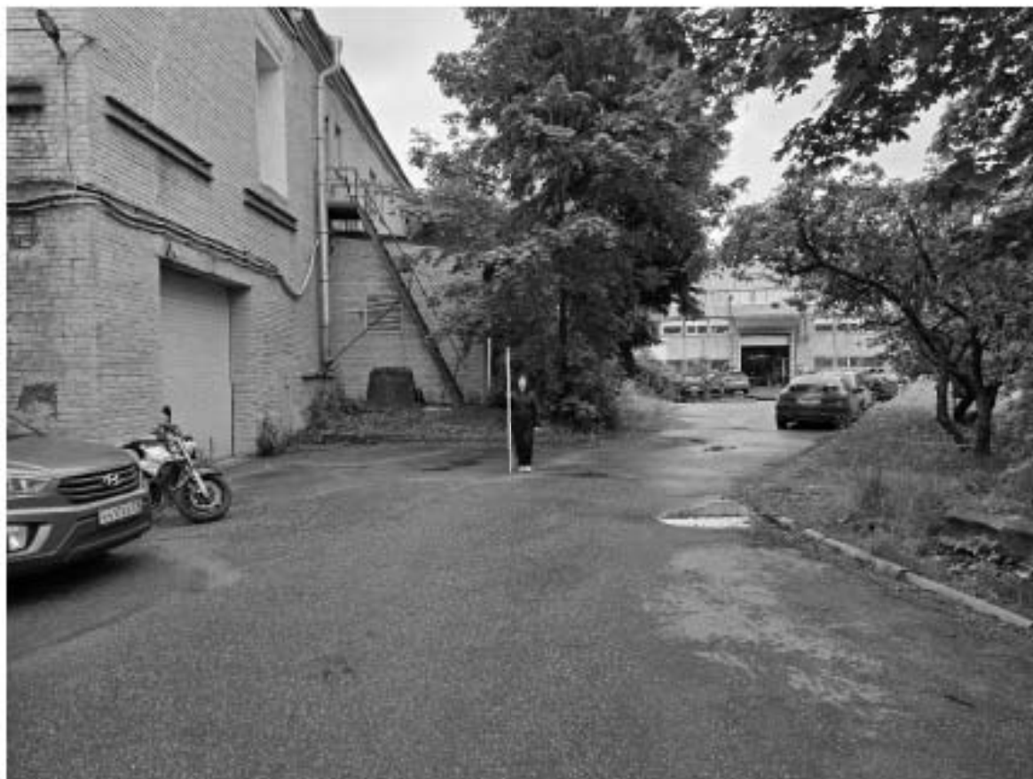
Ил. 17. Санкт-Петербург, Шкиперский проток д. 14. Точка Ф 1. Вид на обследуемый участок с С. Для масштаба использована рейка длиной 2 м.
