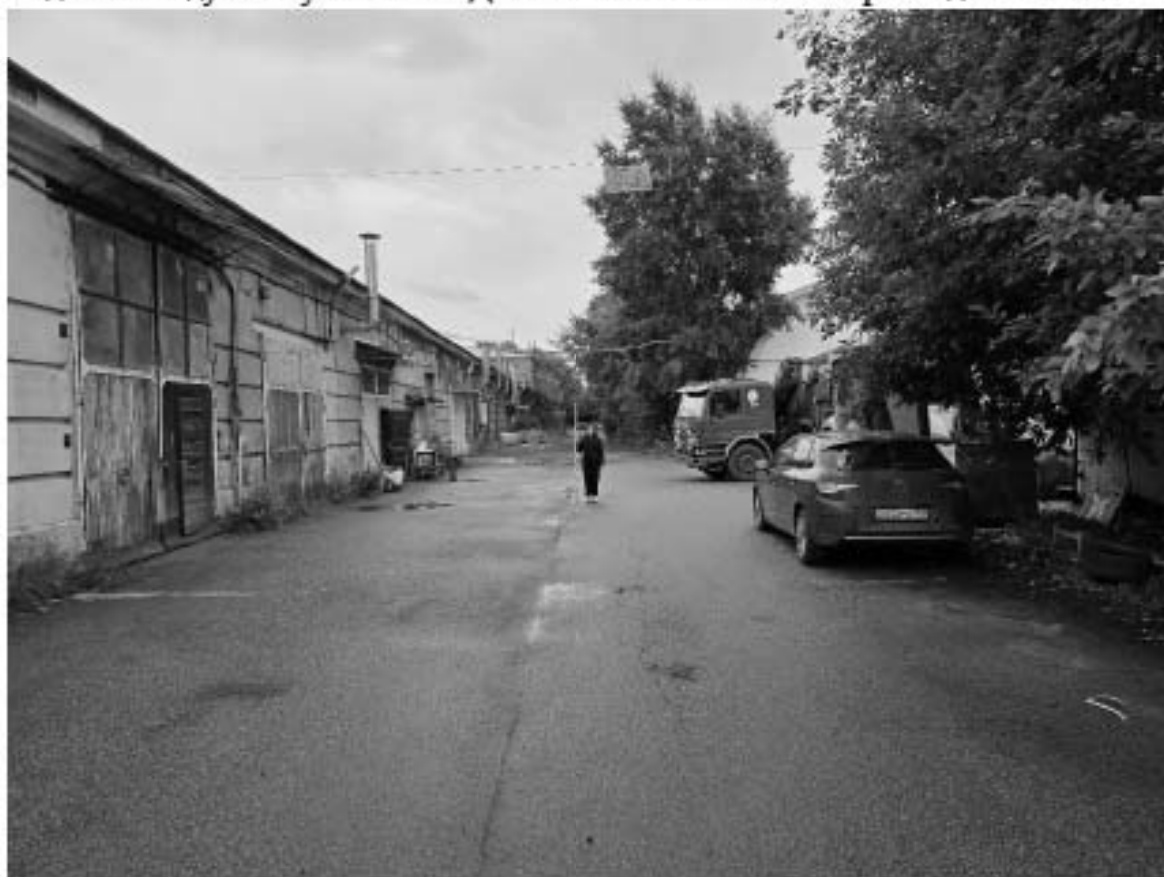
Ил. 22. Санкт-Петербург, Шкиперский проток д. 14. Точка Ф 6. Вид на обследуемый участок с С. Для масштаба использована рейка длиной 2 м.
