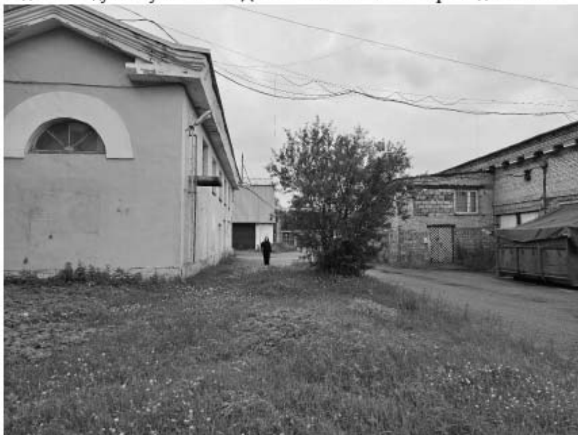
Ил. 20. Санкт-Петербург, Шкиперский проток д. 14. Точка Ф 4. Вид на обследуемый участок с В. Для масштаба использована рейка длиной 2 м.
