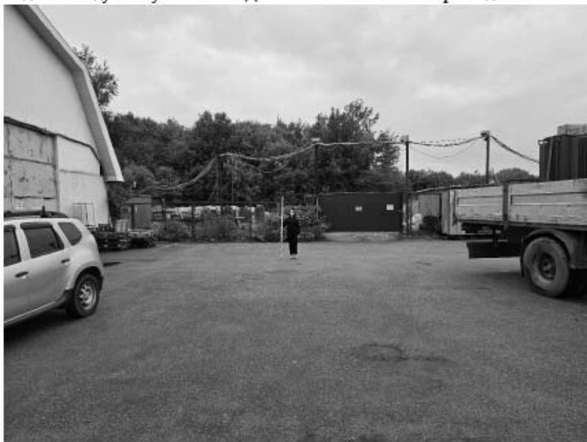
Ил. 24. Санкт-Петербург, Шкиперский проток д. 14. Точка Ф 8. Вид на обследуемый участок с В. Для масштаба использована рейка длиной 2 м.
