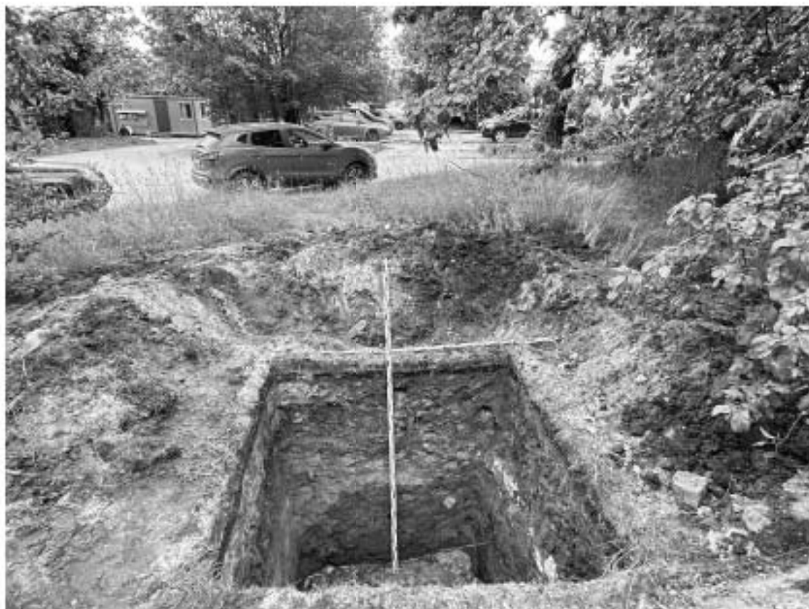
Ил. 51. Санкт-Петербург, Шкиперский проток д. 14. Шурф 2 по завершении работ. Общий вид с Ю.
