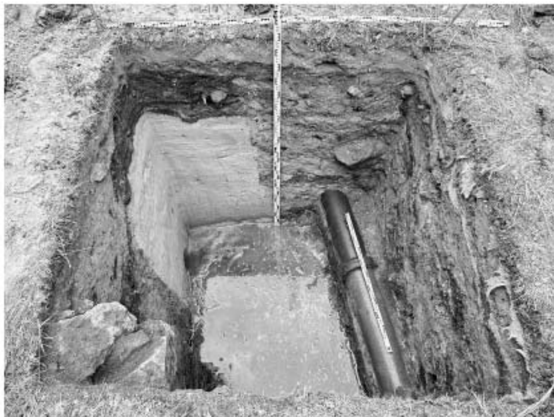
Ил. 41. Санкт-Петербург, Шкиперский проток д. 14. Шурф 1 по завершении работ. Зачистка по верху глинистой засыпки и уровню стояния грунтовых вод. Общий вид с Ю (сверху).
