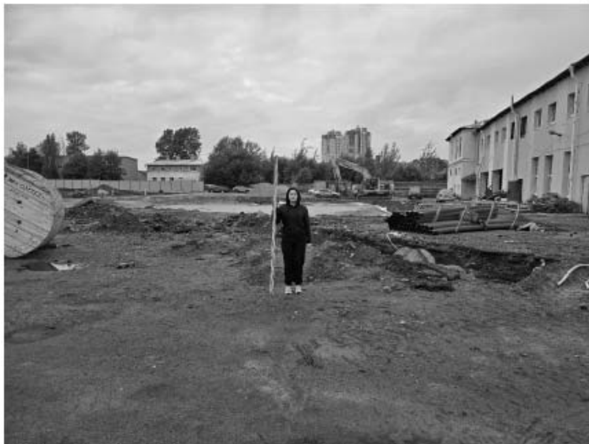
Ил. 31. Санкт-Петербург, Шкиперский проток д. 14. Точка Ф 15. Вид на обследуемый участок с Ю. Для масштаба использована рейка длиной 2 м.
