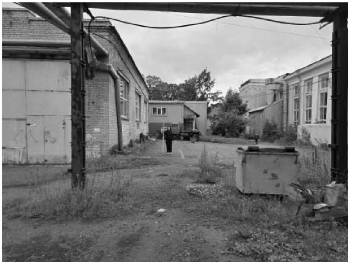
Ил. 27. Санкт-Петербург, Шкиперский проток д. 14. Точка Ф 11. Вид на обследуемый участок с Ю. Для масштаба использована рейка длиной 2 м.
