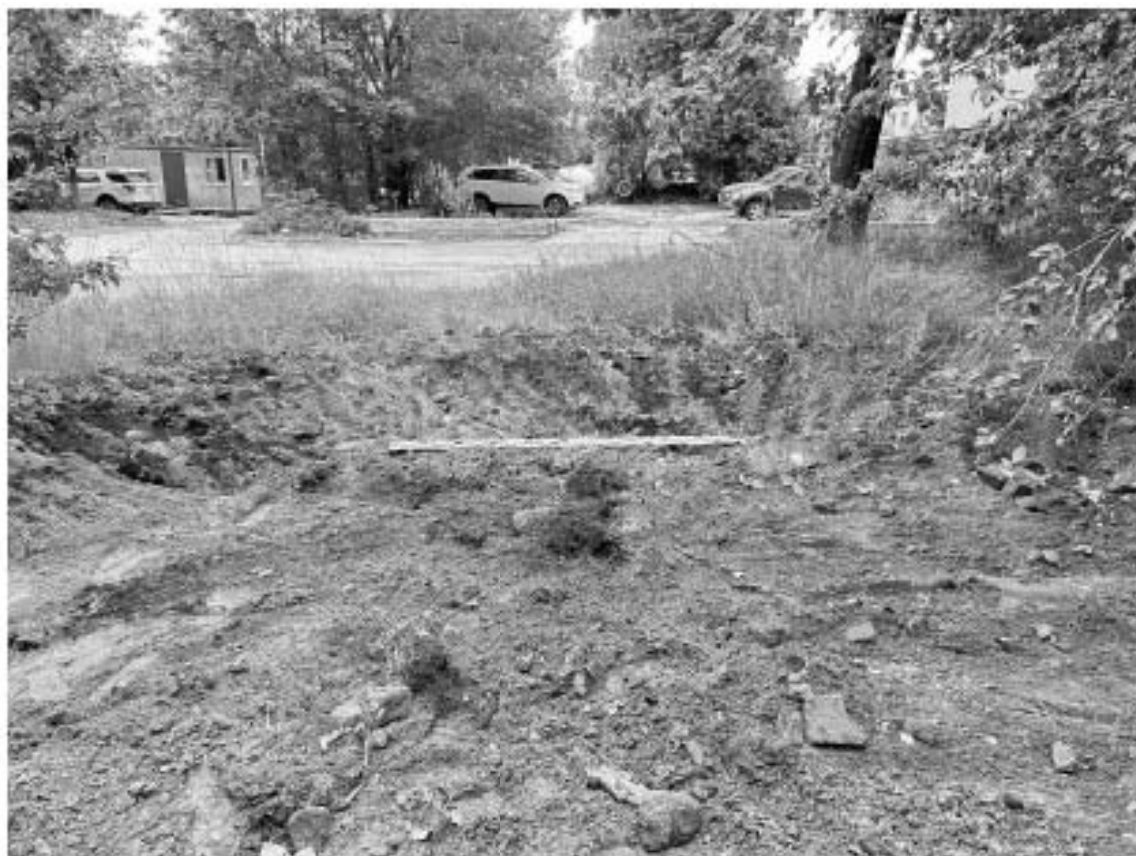
Ил. 59. Санкт-Петербург, Шкиперский проток д. 14. Шурф 2 после рекультивации. Вид с Ю.
