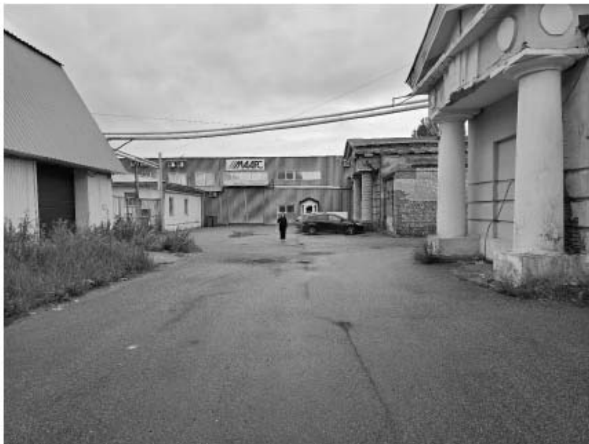
Ил. 23. Санкт-Петербург, Шкиперский проток д. 14. Точка Ф 7. Вид на обследуемый участок с Ю. Для масштаба использована рейка длиной 2 м.
