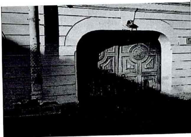
Фото 3. Воротные заполнения лицевого фасада
