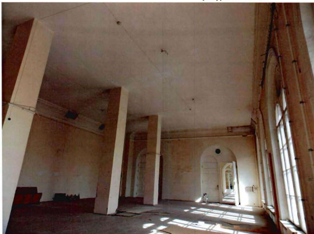
6. Помещение 3 этажа (41-Н).
