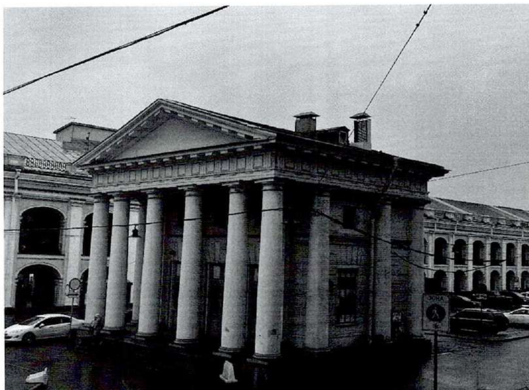
Северный и западный фасады
