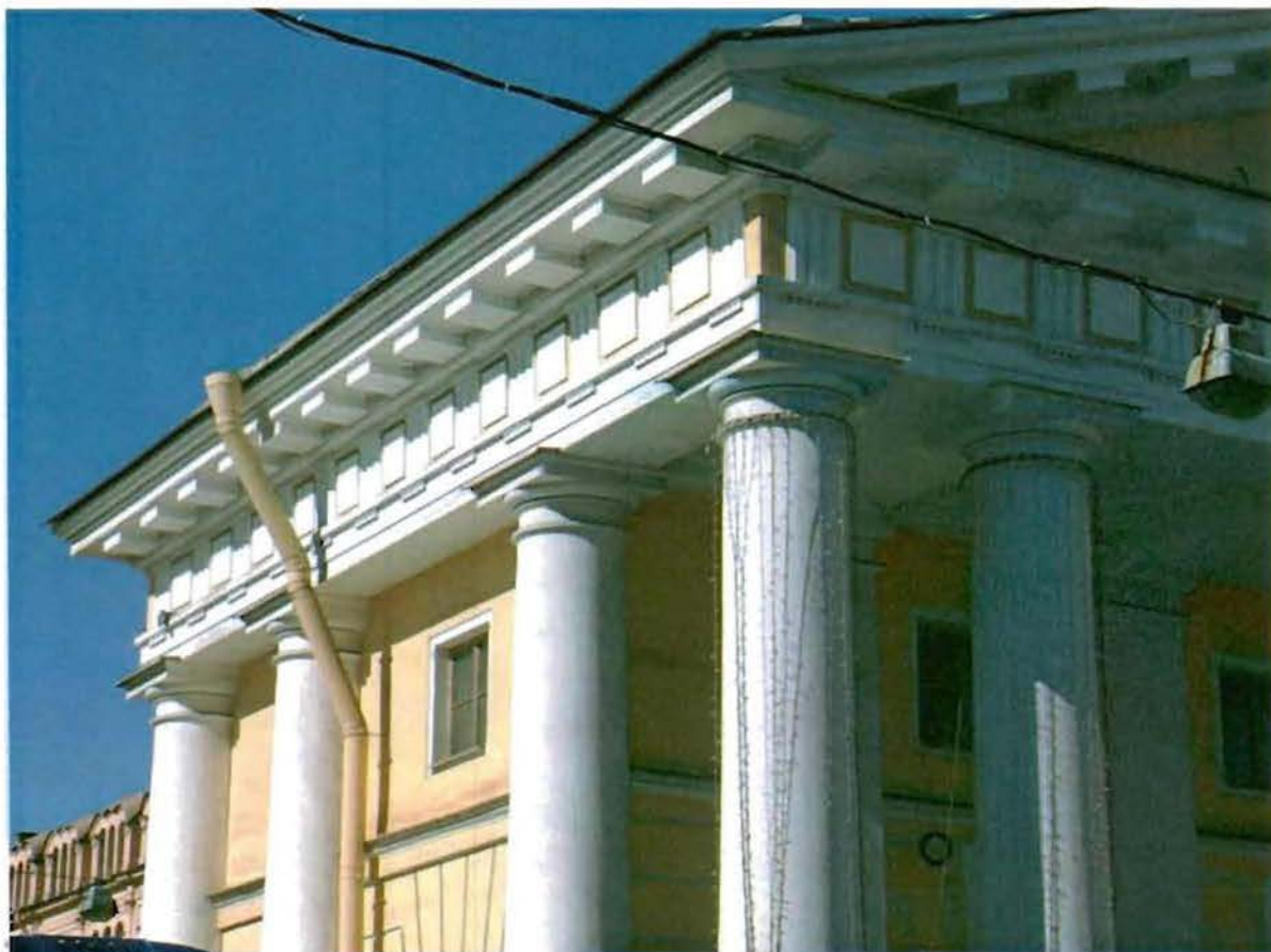
Фото 4. Часть восточного фасада.
