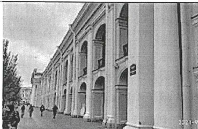
Фото 1. Фасад Невской линии
