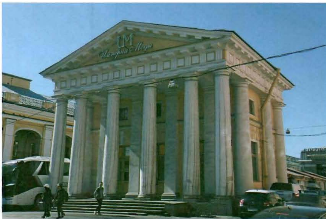
Фото 1. Северный и западный фасад.
