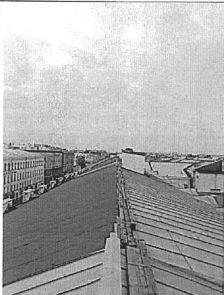
Фото 17. Кровля по Садовой линии
