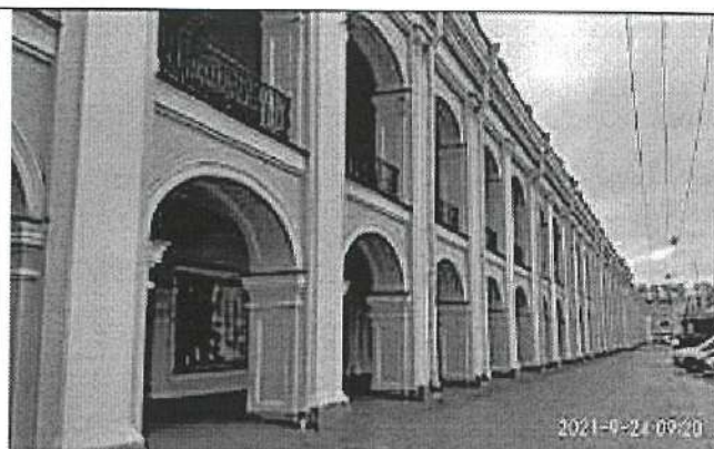
Фото 4. Фасад Садовой линии
