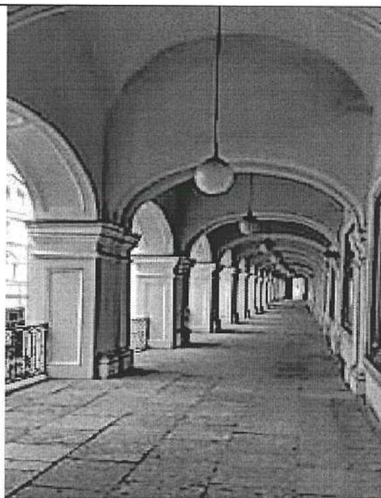
Фото 8. Крытая арочная галерея Ломоносовской линии 2 этажа
