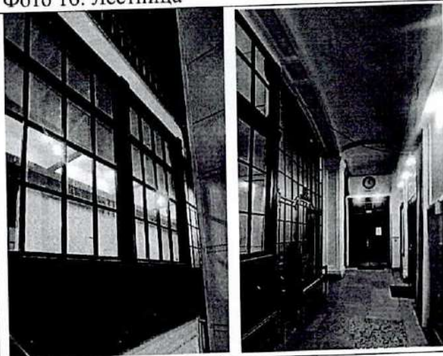
Фото 18. Заполнения проемов лестничной площадки
