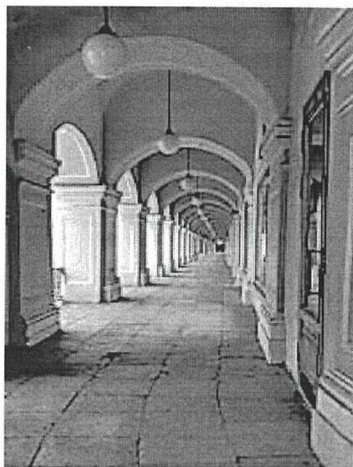
Фото 7. Крытая арочная галерея Садовой линии 1 этажа
