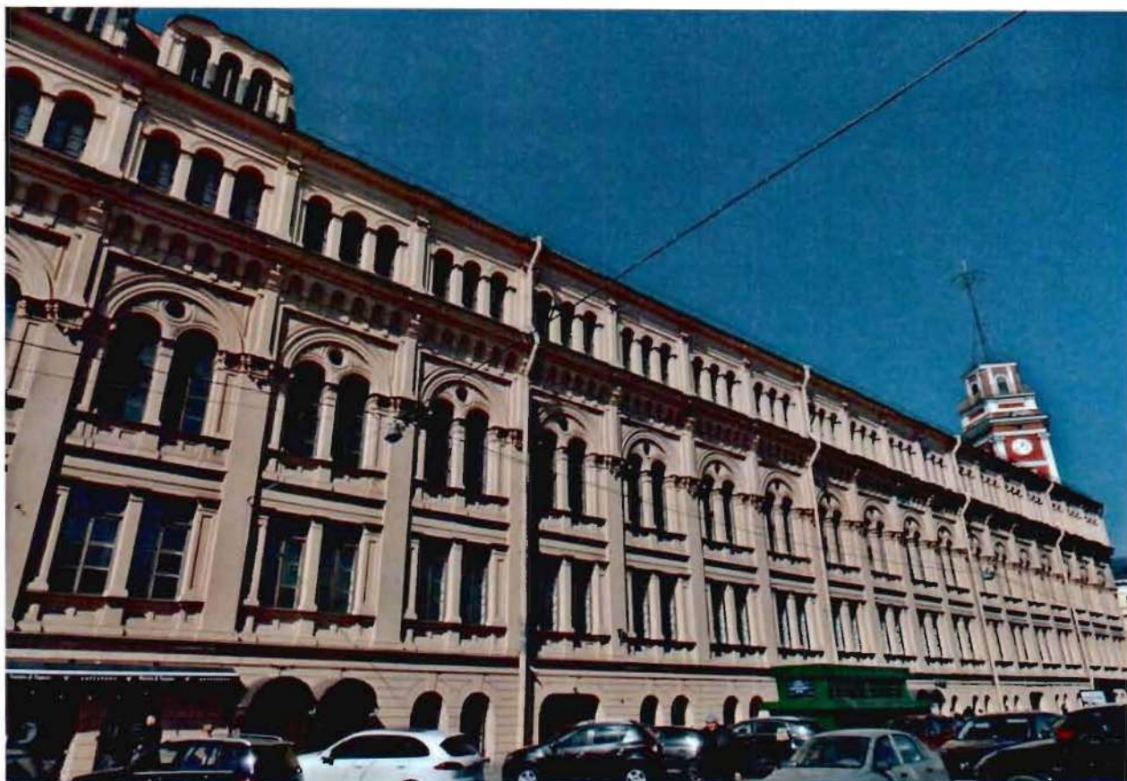
2. Вид на восточный фасад объекта культурного наследия.
