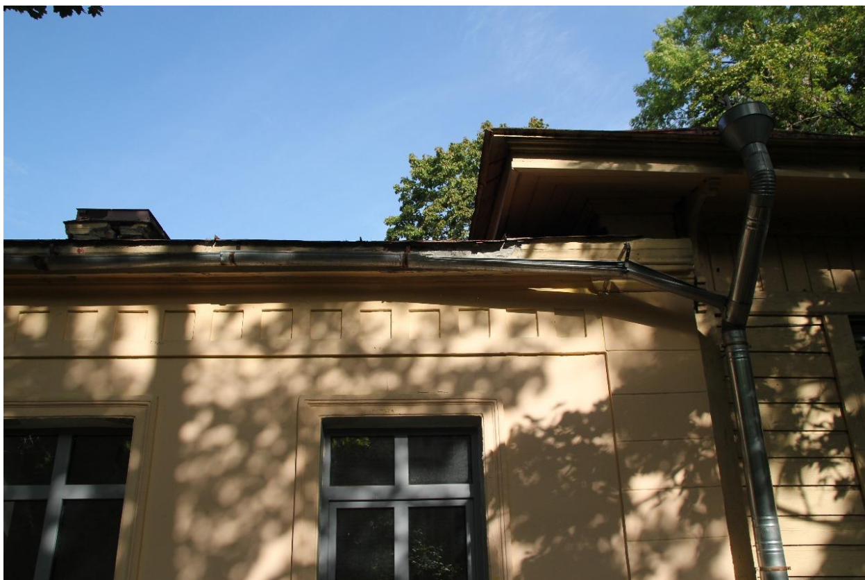
17. Фрагмент крыши с южной стороны здания.
