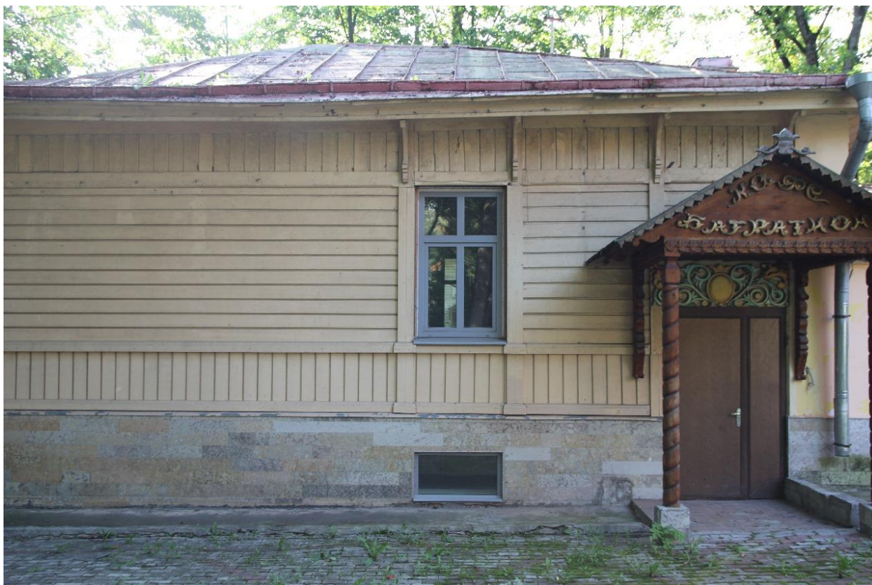
7. Вид на северный фасад деревянной части здания.
