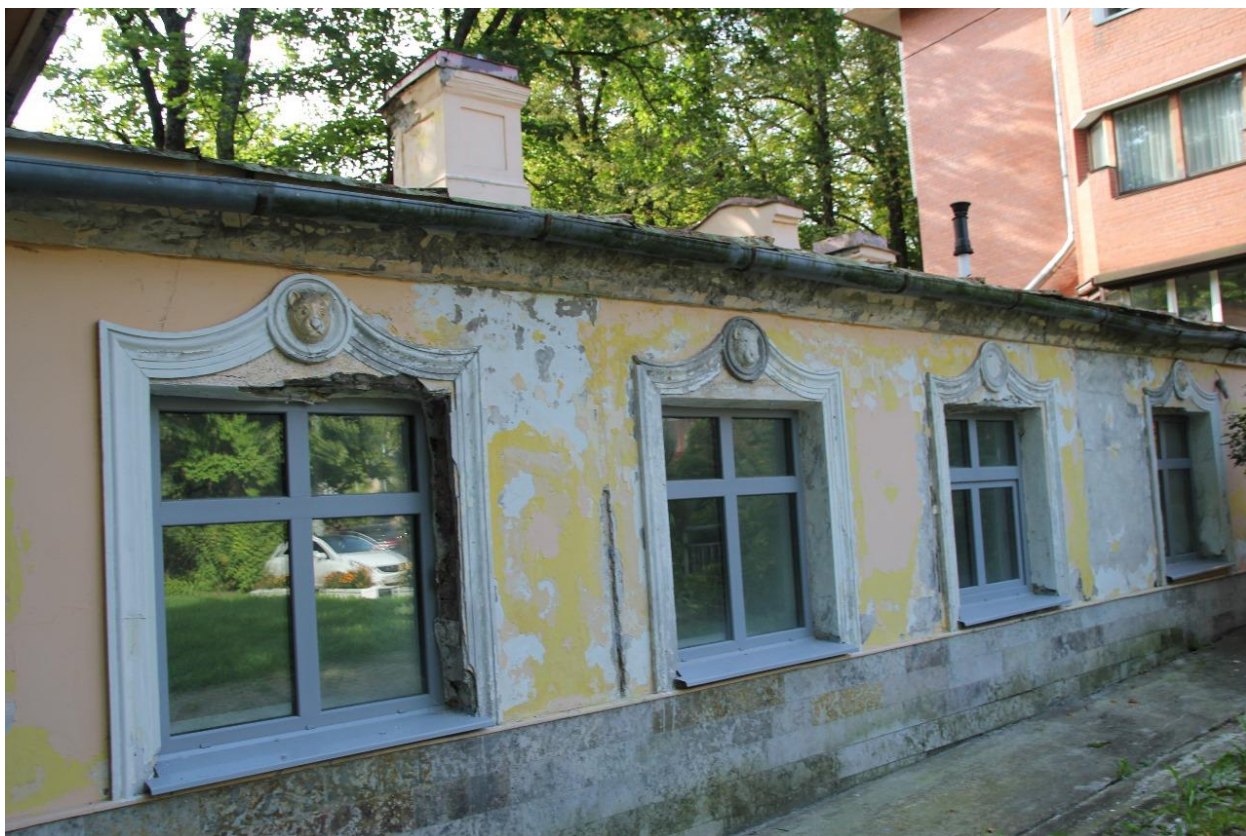
11. Восточная часть северного фасада кирпичной части здания, вид с северо-востока.
