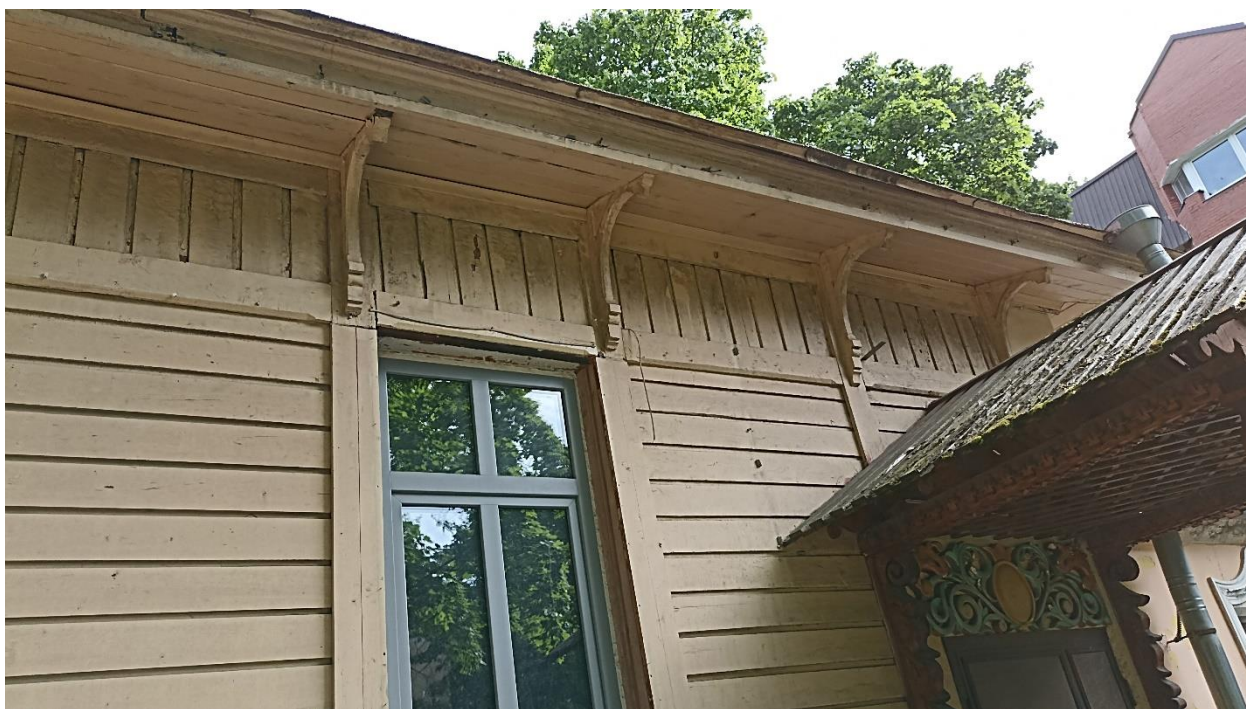
9. Фрагмент северного фасада деревянной части здания.
