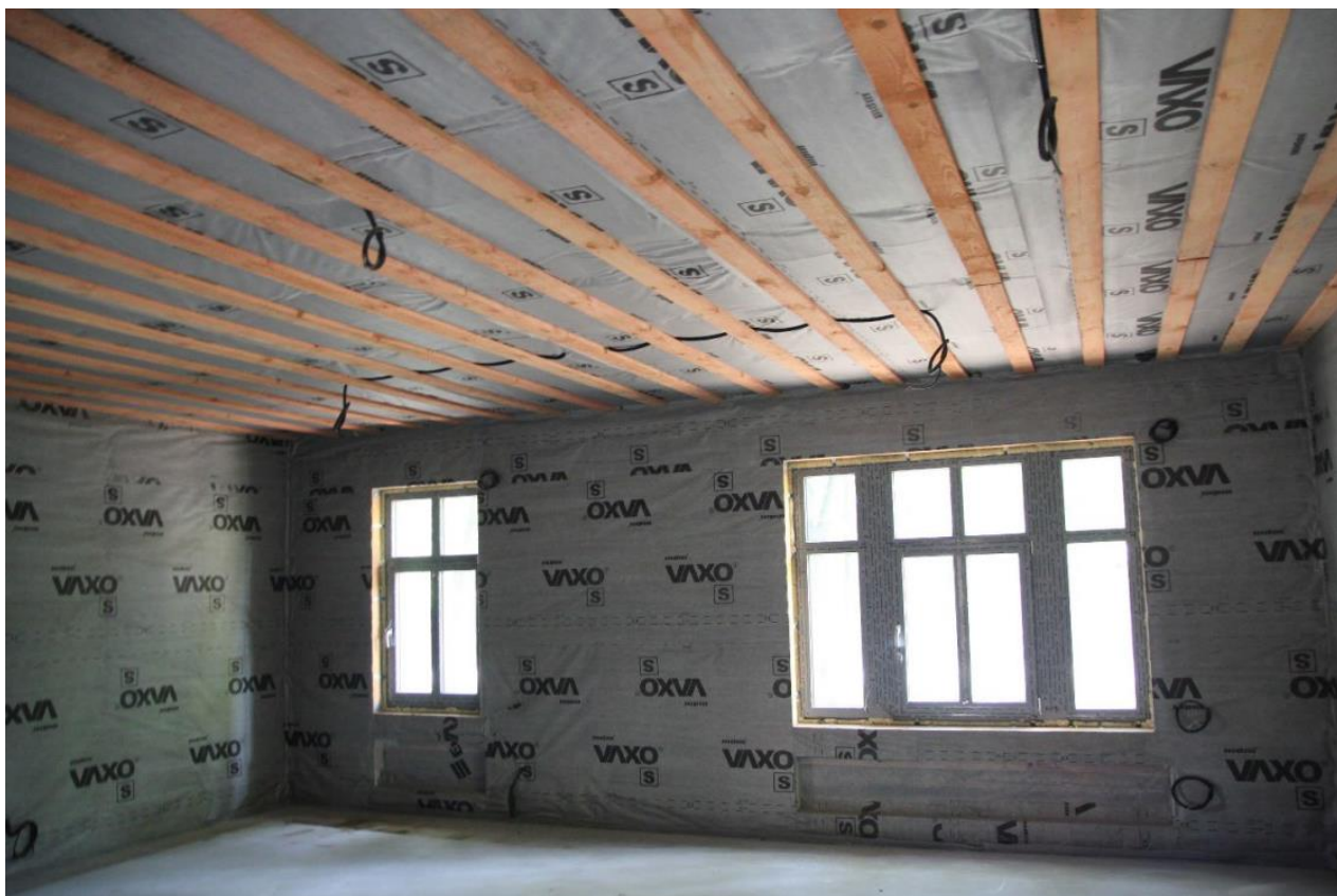
19. Помещение №105. Основное помещение деревянной части здания.
