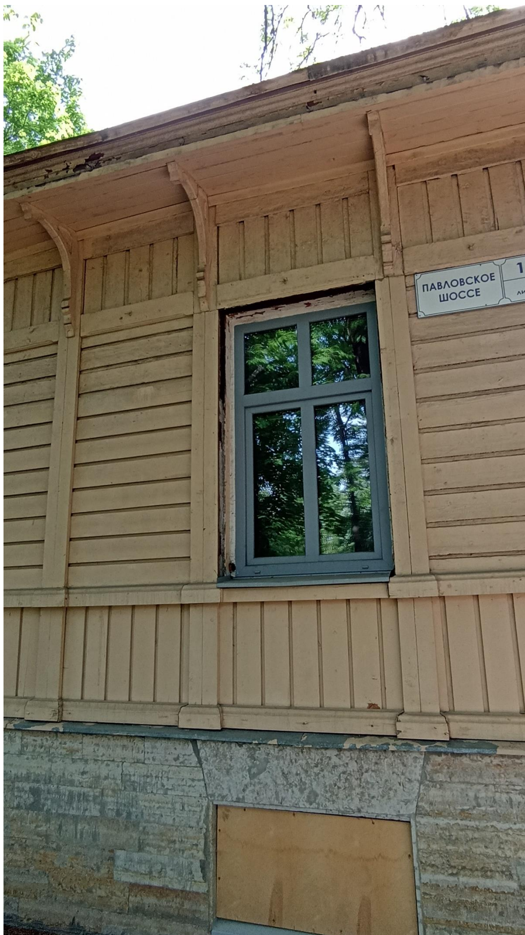
13. Северная часть восточного фасада.
