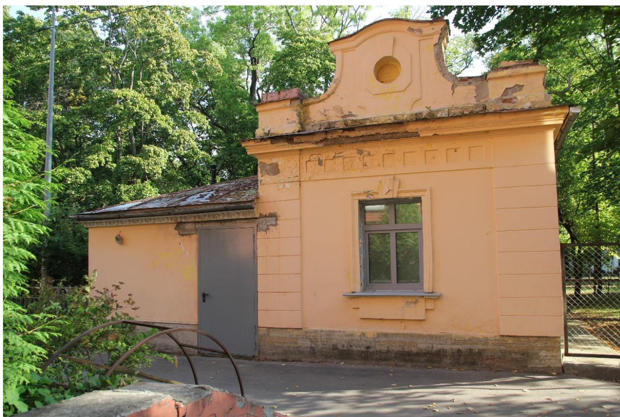
2. Вид на западный фасад.
