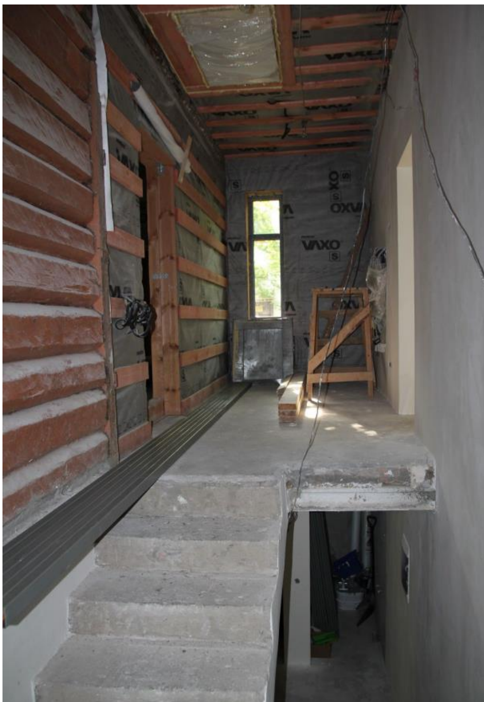
18. Помещение 109. Внутреннее помещение главного входа, современная железобетонная лестница.
