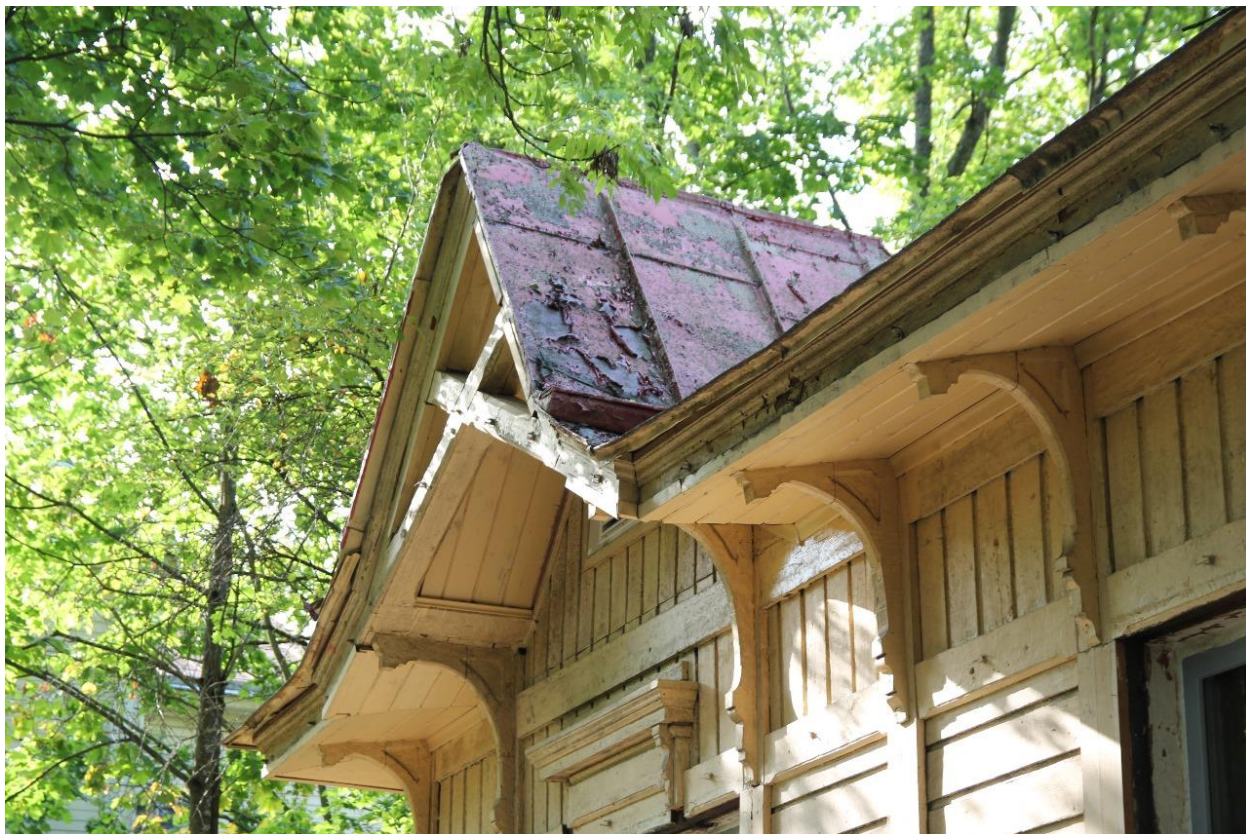
14. Фрагмент крыши с восточной стороны здания.
