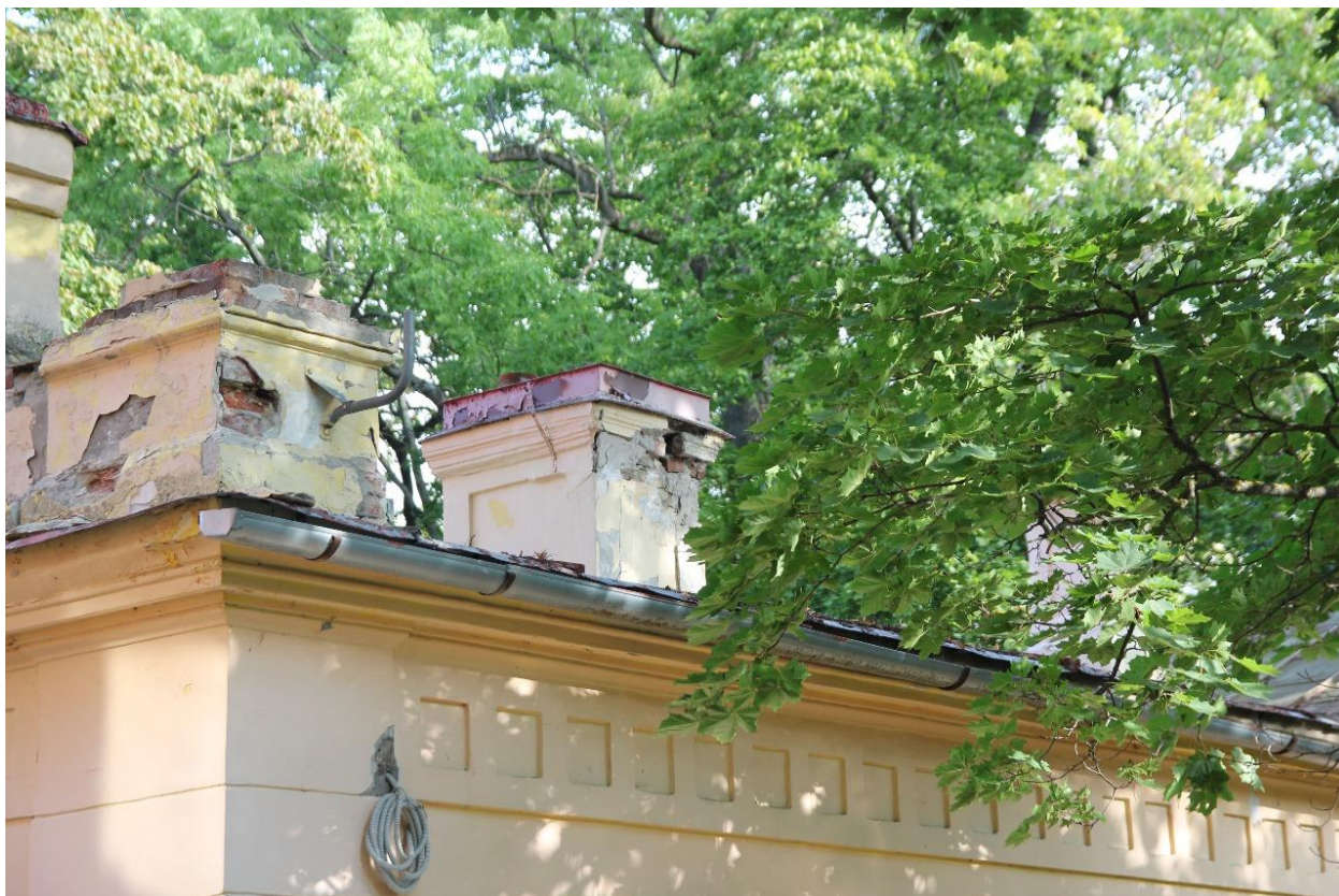
4. Фрагмент крыши южного фасада.
