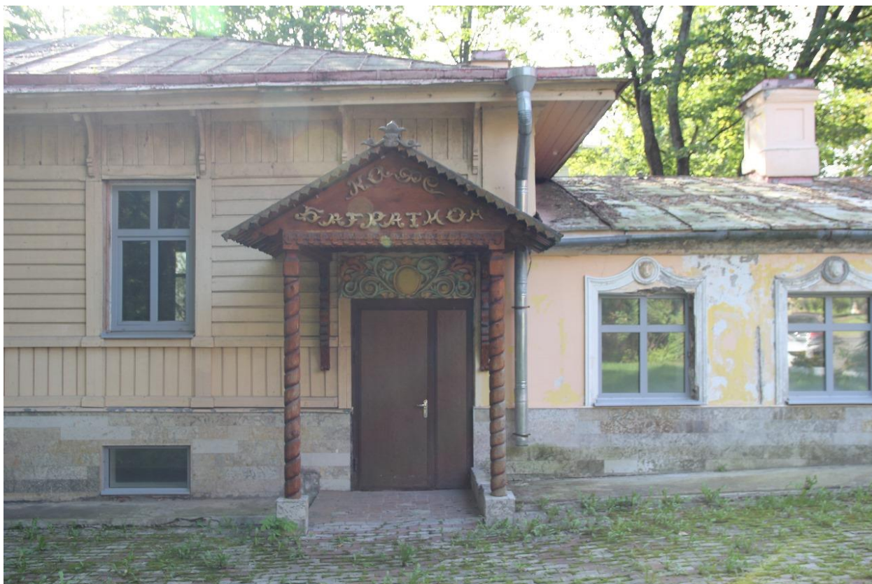
6. Вид на северный фасад здания. Фрагмент центральной части.
