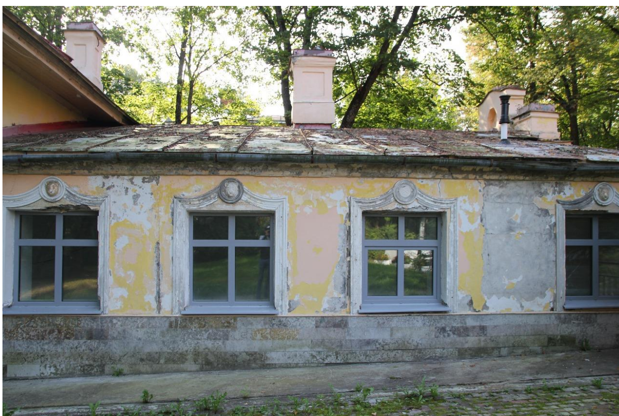
10. Вид на северный фасад кирпичной части здания с севера.
