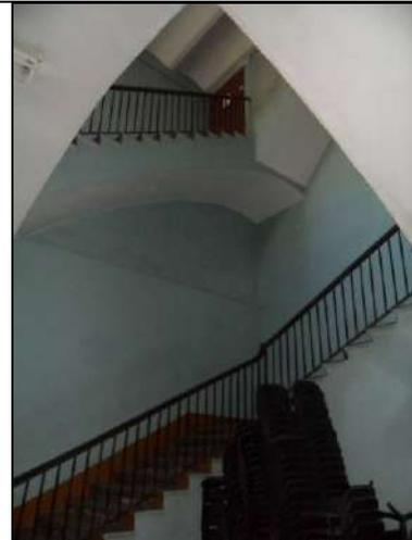
помещение 15-Н(30) (площадь 163, 9 кв. м) (библиотека) – винтовая металлическая лестница с ограждением в виде ажурных вертикальных стоек; материал (дерево) и конфигурация поручней;
