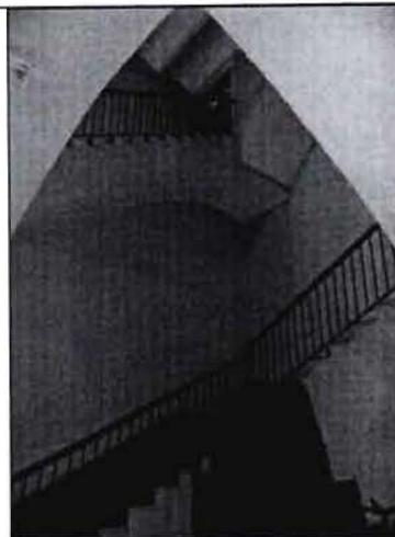
помещение 15-Н(30) (площадь 163, 9 кв. м) (библиотека) – винтовая металлическая лестница с ограждением в виде ажурных вертикальных стоек; материал (дерево) и конфигурация поручней;
