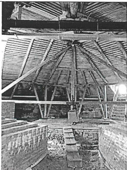
Фото 19-20. Чердачные помещения и стропильная система
