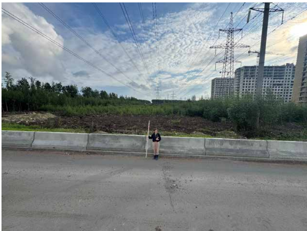
Илл. 37. г. Санкт-Петербург, Выборгский район, пос. Парголово – 2025 г. Точка фотофиксации №4. Вид с СВ.
