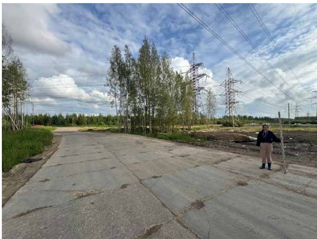
Илл. 32. г. Санкт-Петербург, Выборгский район, пос. Парголово – 2025 г. Точка фотофиксации №2. Вид с С.
