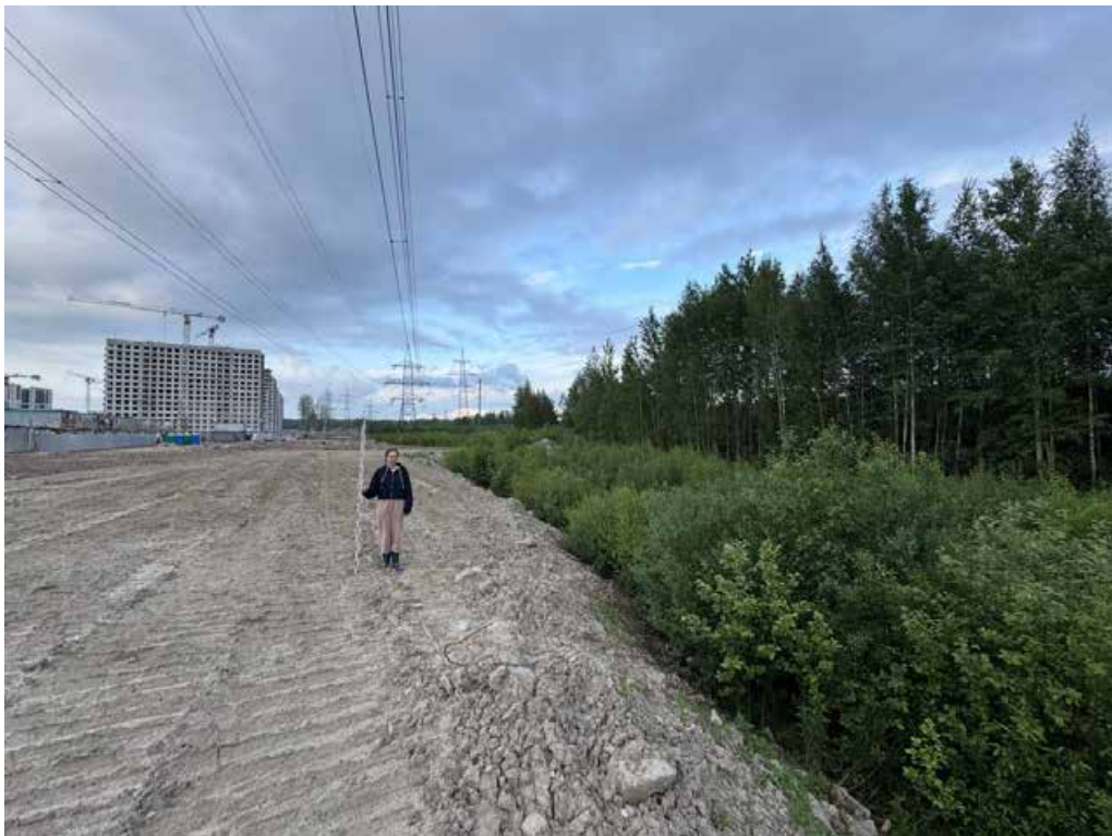
Илл. 52. г. Санкт-Петербург, Выборгский район, пос. Парголово – 2025 г. Точка фотофиксации №10. Вид с ЮЗ.
