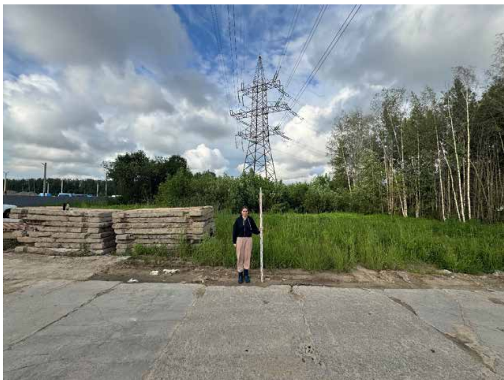
Илл. 30. г. Санкт-Петербург, Выборгский район, пос. Парголово – 2025 г. Точка фотофиксации №2. Вид с ЮЗ.
