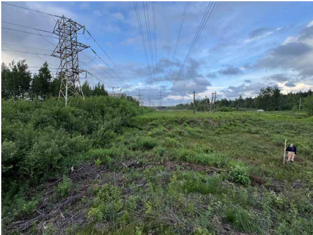
Илл. 49. г. Санкт-Петербург, Выборгский район, пос. Парголово – 2025 г. Точка фотофиксации №8. Вид с ЮЗ.
