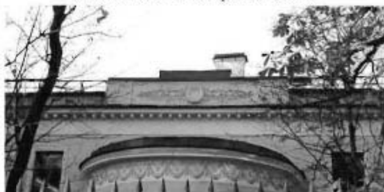
5. Аттик восточного фасада здания
