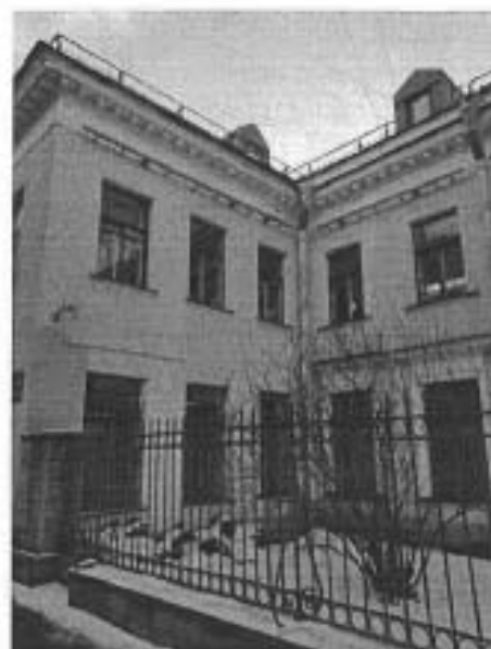
4. Фрагмент лицевого фасада
