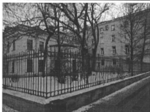
1. Ограда общий вид
