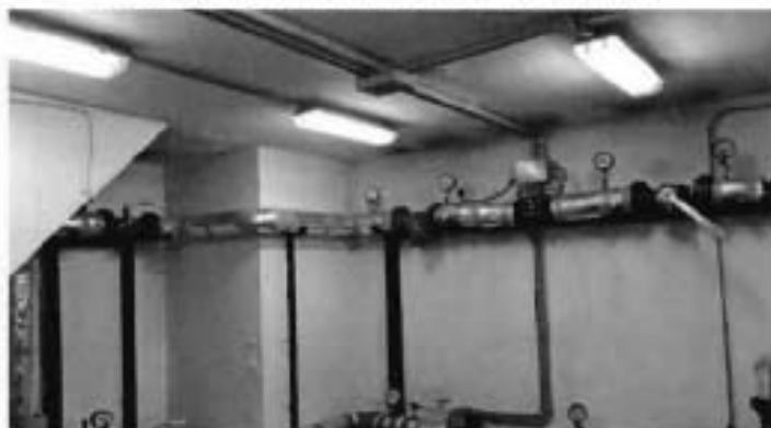
30. Интерьер подвального помещения
