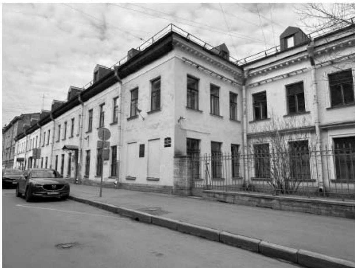
Фото 2. Общий вид здания по 4-ой Красноармейской ул.
