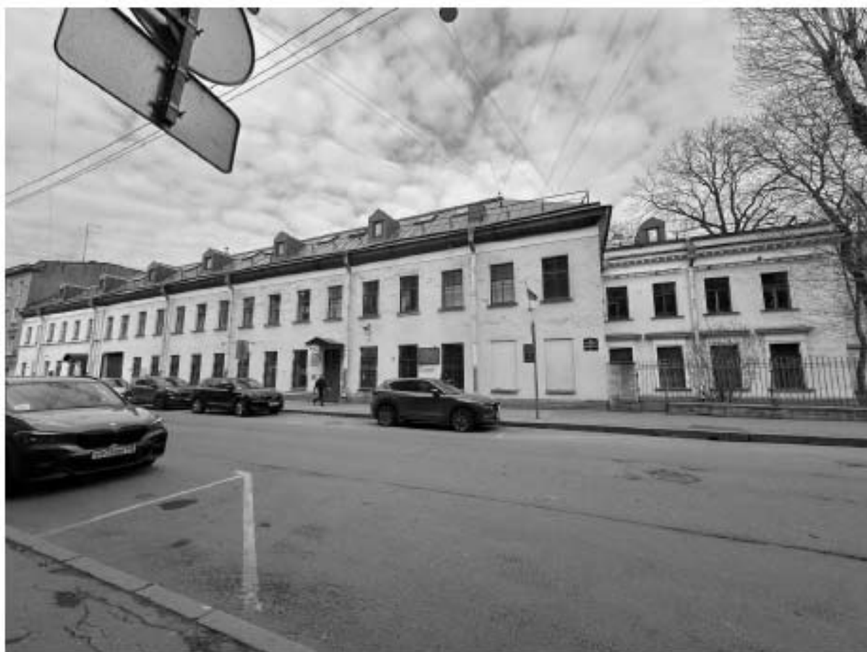
Фото 1. Общий вид здания по 4-ой Красноармейской ул.
