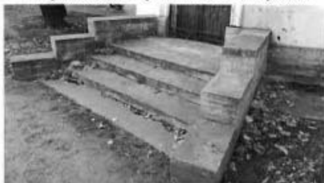
4. Крыльцо со стороны восточного фасада
