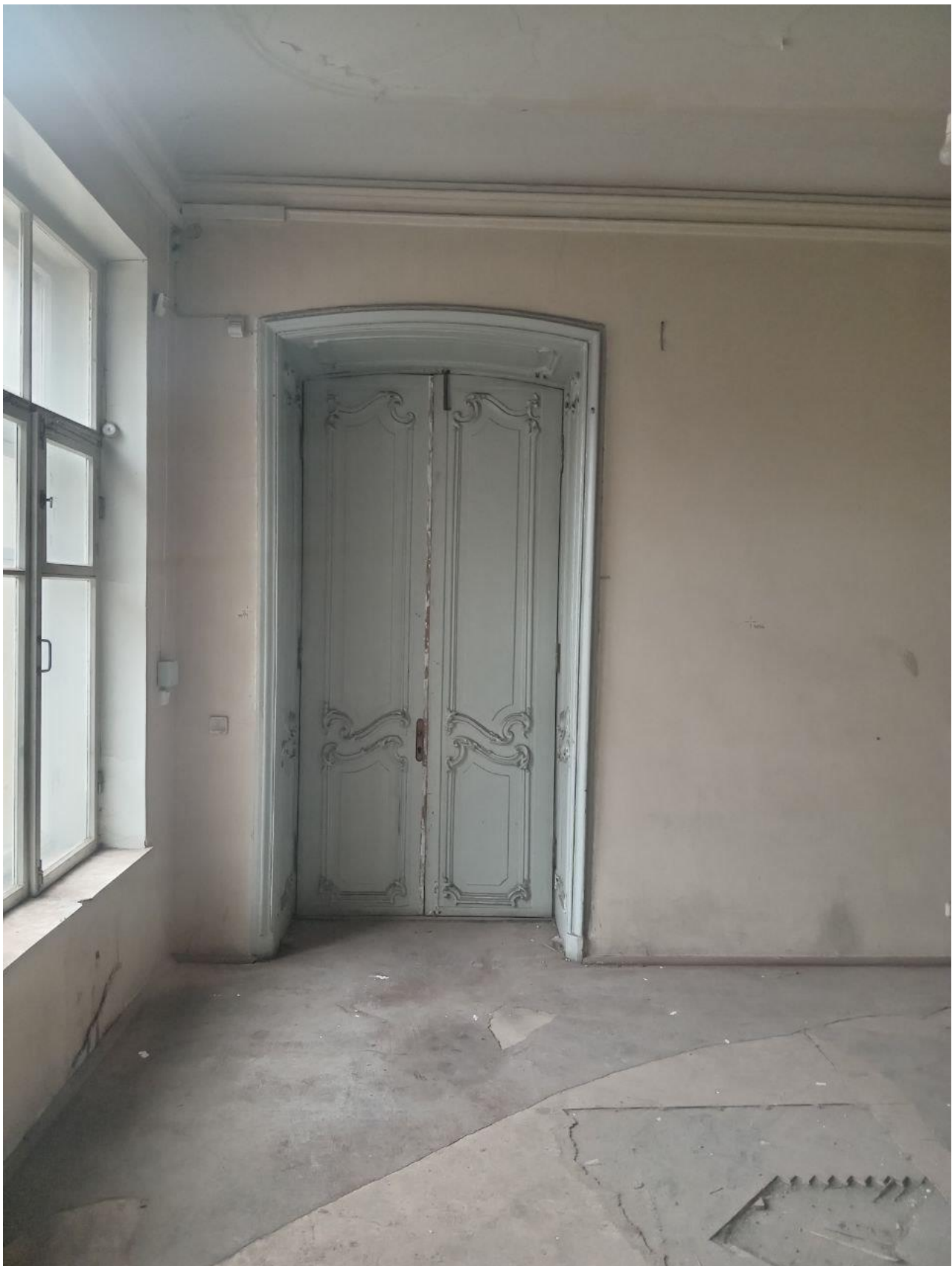
Фото 46. Помещение 3Н(12) (Передняя). Вид на 1ЛК (5). Исторический дверной проем с лучковой перемычкой. Профилированные наличники; откосы, облицованные филенчатыми фигурными деревянными панелями. заполнение дверных проемов – дуб, сосна, резьба, двери двустворчатые, профилированные филенки криволинейной формы, по две на каждом полотне, с резным обрамлением в виде стилизованных стеблей растений и завитков.
