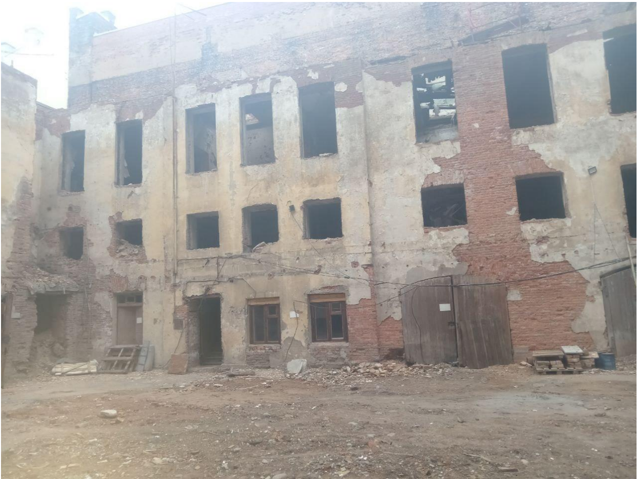
Фото 8. Фрагмент юго-западного дворового фасада.
