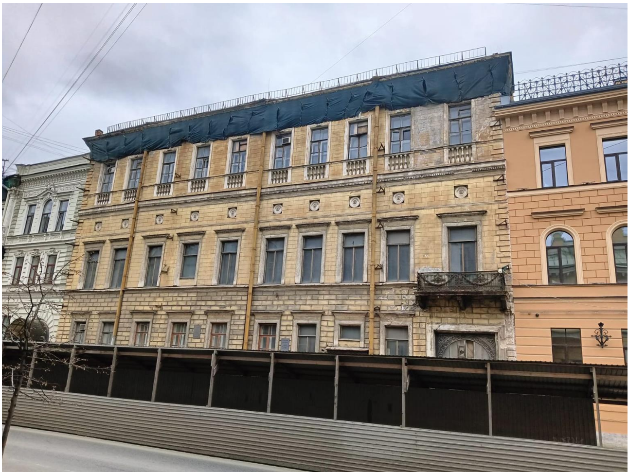
Фото 1. Лицевой фасад. Выполнен в приемах ранней эклектики, с элементами классицизма. Вид материала и характер отделки — окрашенная штукатурка (руст квадром- в уровне 1-го этажа, уплощенный руст — в уровне 2-3 этажей). исторические оконные проемы, в том числе балконный — местоположение, габариты, конфигурация (прямоугольные, включая окно с лучковым завершением воротного проезда); для окон цокольного этажа — габариты ширины и отметки перемычек; исторический материал (дерево), рисунок и цвет оконных заполнений; оформление оконных проемов: профилированные наличники, линейные сандрики, подоконные доски на каннелированных консолях с патерой между ними — в уровне 1-го этажа; профилированные наличники, линейные сандрики, декорированные мелкими дентикулами; профилированные наличники, замковые камни в виде орнаментированных волют, подоконные ложные балюстрады — в уровне 3-го этажа; квадратные ниши с лепными розетками внутри — в уровне между 2-3-м этажами; рустованные лопатки по углам здания (руст «вперебежку» - в уровне 2-3-го этажей); профилированные междуэтажные и подоконные тяги и карнизы, включая тягу с дентикулами.
