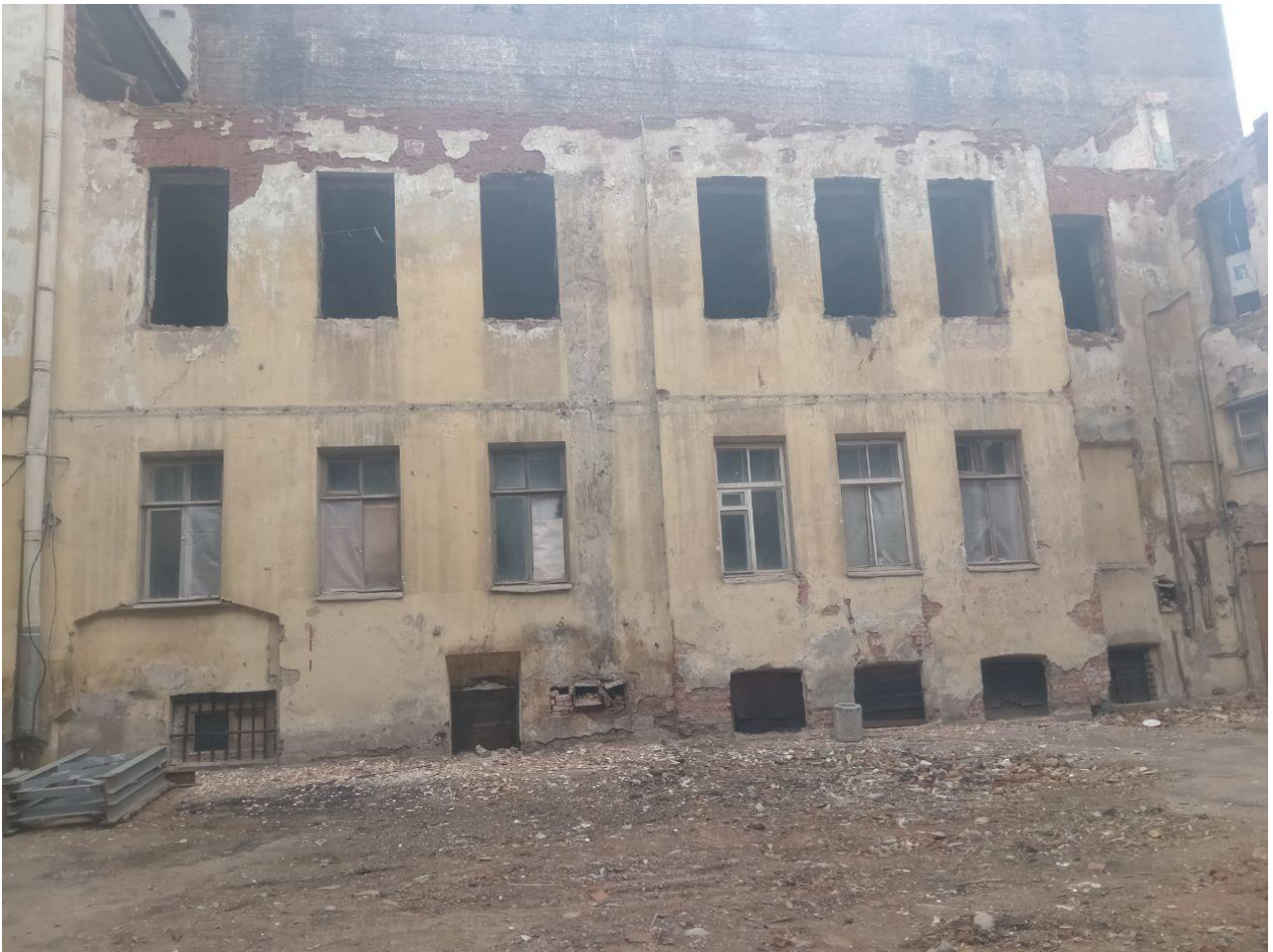
Фото 9. Фрагмент северо-восточного дворового фасада.
