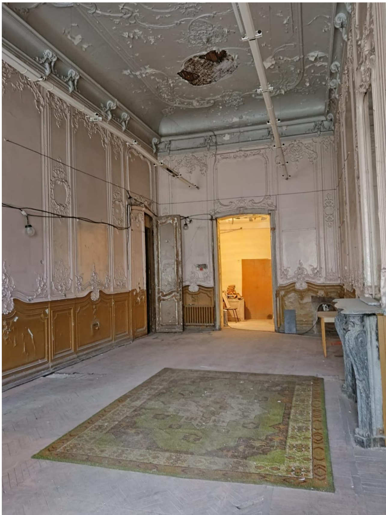
Фото 32. Фрагмент Помещения 3Н(1). Вид выход в пом 1ЛК(5) и 3Н(27) десюдепорты - лепные зеркала, образованные фигурной профилированной тягой с и картушем (сверху) и медальоном (снизу) – расположены по центральной оси (над картушем дверной перемычки).
