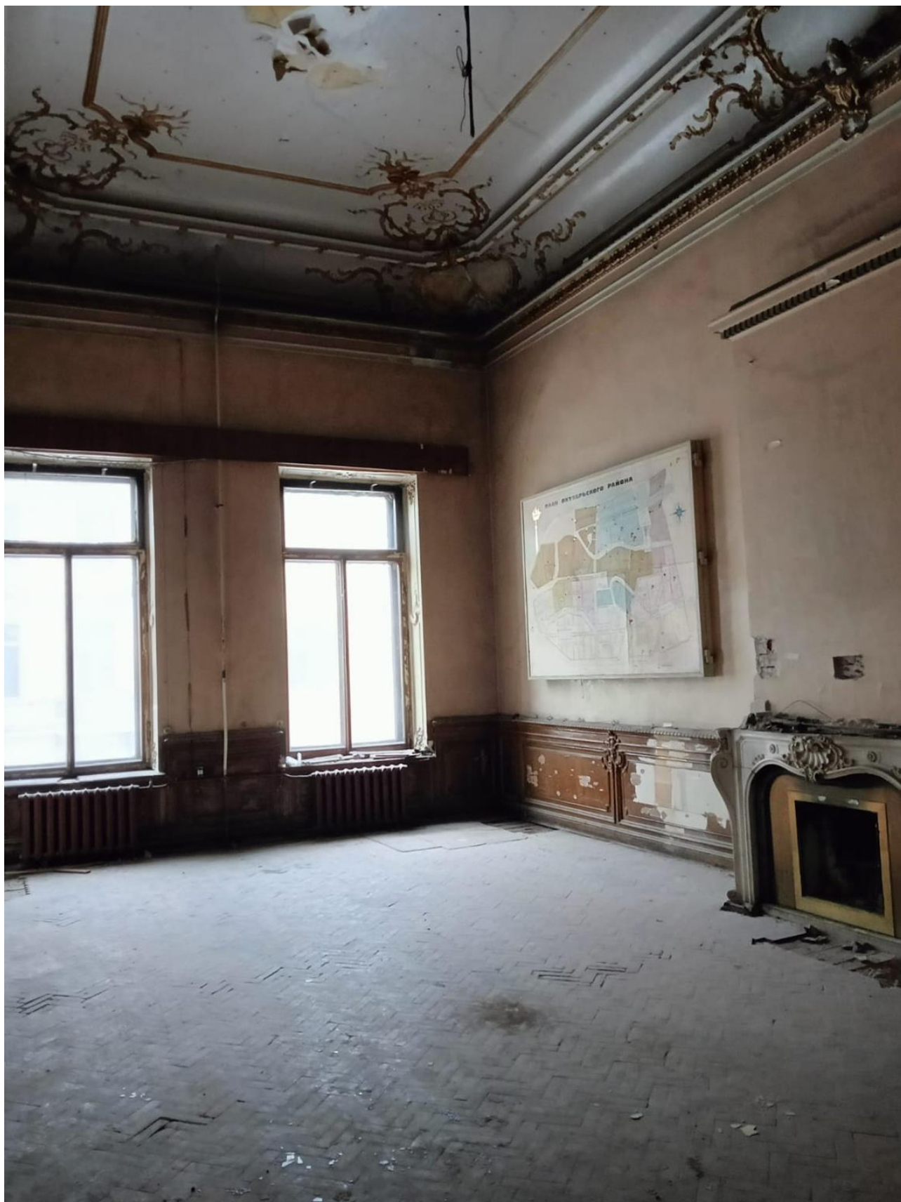
Фото 45. Помещение 3Н(10). (Большой кабинет). Оформление плафона – профилированный карниз, орнаментированный цветами и листьями, порезка иоником; падуга, завершенная лепной тягой в виде перевитой крест-накрест арматуры; в углах лепные композиции из акантовых завитков, рокайлей, розовых гирлянд, медальонов с вензелями.
