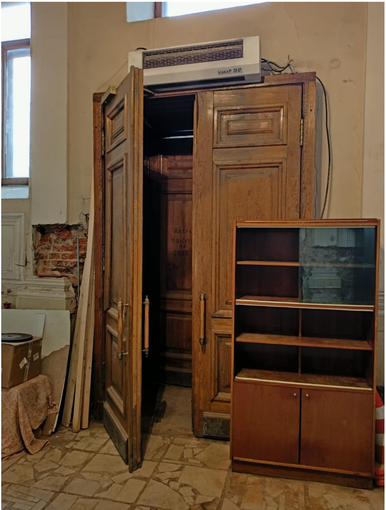
Фото 17. Фрагмент помещения ЛК1(1). Вид на тамбур входа парадной лестницы. Оформление стен и потолка – обшиты дубовыми филленчатыми панелями. заполнение дверного проема – материал (дуб), конструкция (двери двухстворчатые), оформление (профилированные филленки); прибор дверной – ручка-скоба с круглым деревянным стержнем, с латунными наконечниками с шишками, на круглых латунных цапфах.
