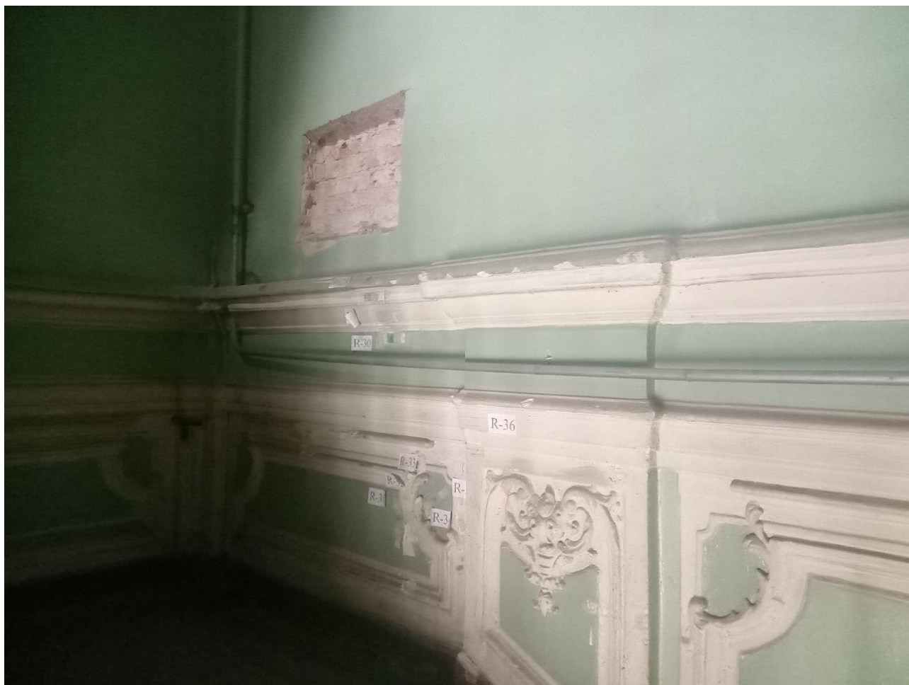
Фото 23. Помещение 1ЛК. Вид на площадку между 1 и 2 этажами. На в верхней части капителей лепные композиции из «S»-образных завитков аканта, розовых гирлянд; между ними профилированные зеркала с вогнутыми углами, которые окаймлены листом аканта.
