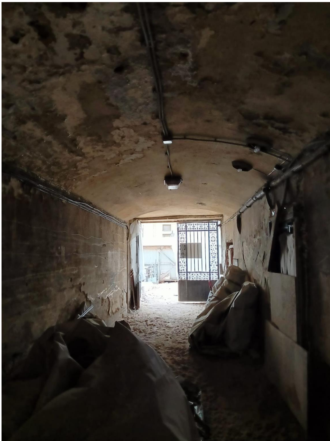
Фото 6. Воротный проезд. В сторону Б. Морской ул. Свод коробовый с распалубками.
