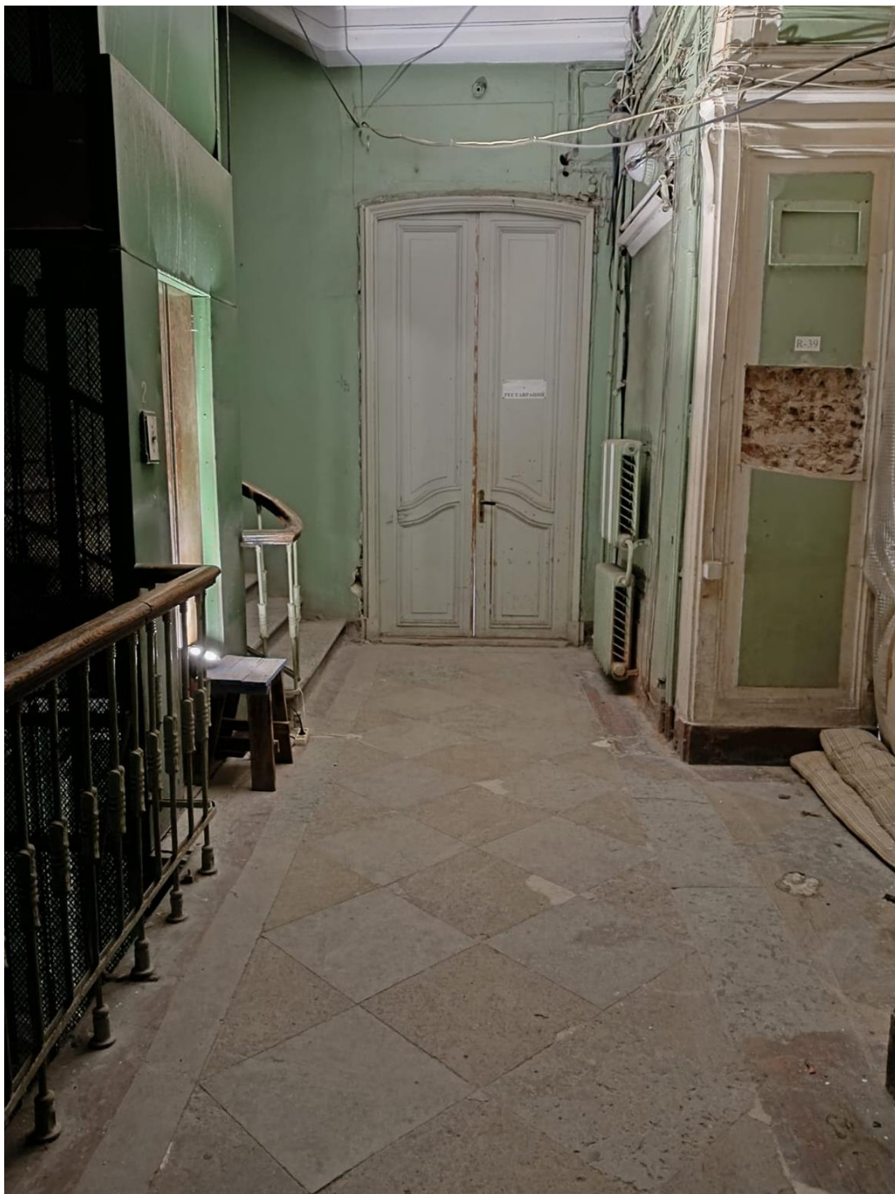
Фото 25. Помещение 1ЛК(5). Площадка 2 этажа. Заполнение дверных проемов – материал (дуб, сосна, резьба), конструкция (двери двустворчатые), оформление (профилированные филенки криволинейной формы, по две на каждом полотне, с резным обрамлением в виде стилизованных стеблей растений и завитков); время: 1846-1847 гг.
