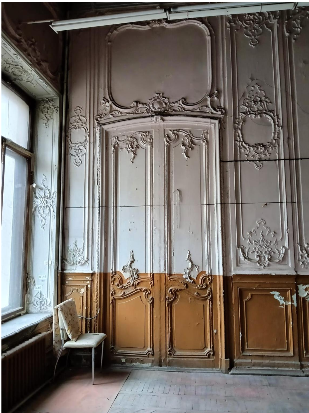
Фото 31. Фрагмент Помещения 3Н(1). Двери двустворчатые, оформление (профилированные фигурные филенки с резными композициями из С-образных и акантовых завитков); время: 1846-1847 гг.
