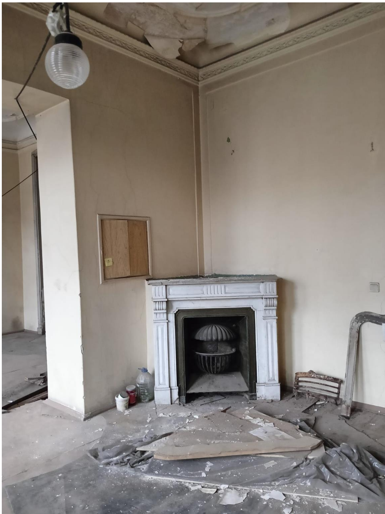
Фото 49. Помещение ЗН(11) (Вторая передняя). Вид на пом. ЗН(12). Камин средистенный, белого мрамора топочное отверстие в прямоугольной раме со срезанными раскрепованными углами; обшито латунным листом с профилированными тягами; с боковыми стенками, облицованными латунными листами; таган чугунный, литой, в форме полукруглой чаши из расходящихся веером стержней, с завершением в виде раковины.
