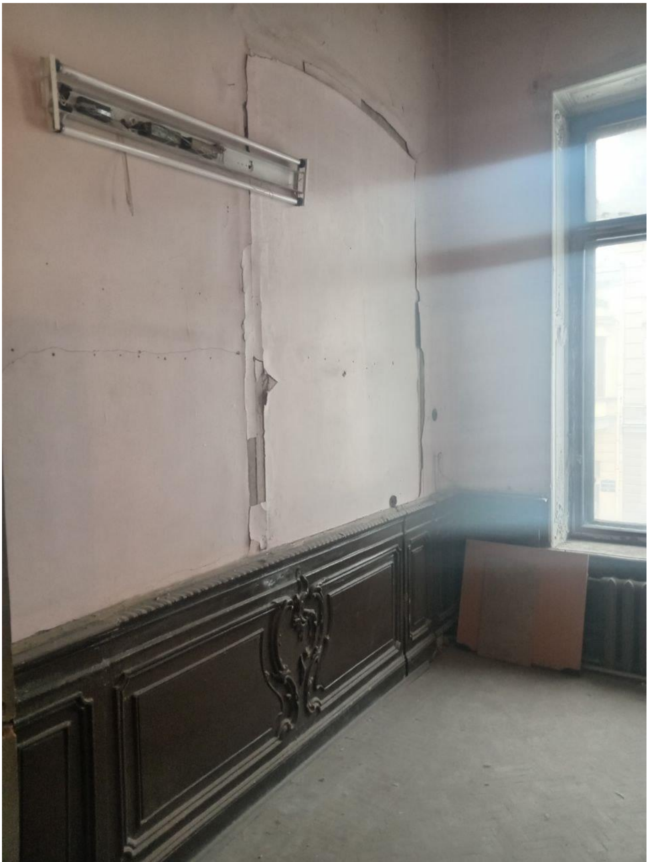
Фото 33. Фрагмент помещения 3Н(8) (Гостиная). Исторический дверной проем в пом. 3Н(1) закрыт деревянными панелями в поздний период.
