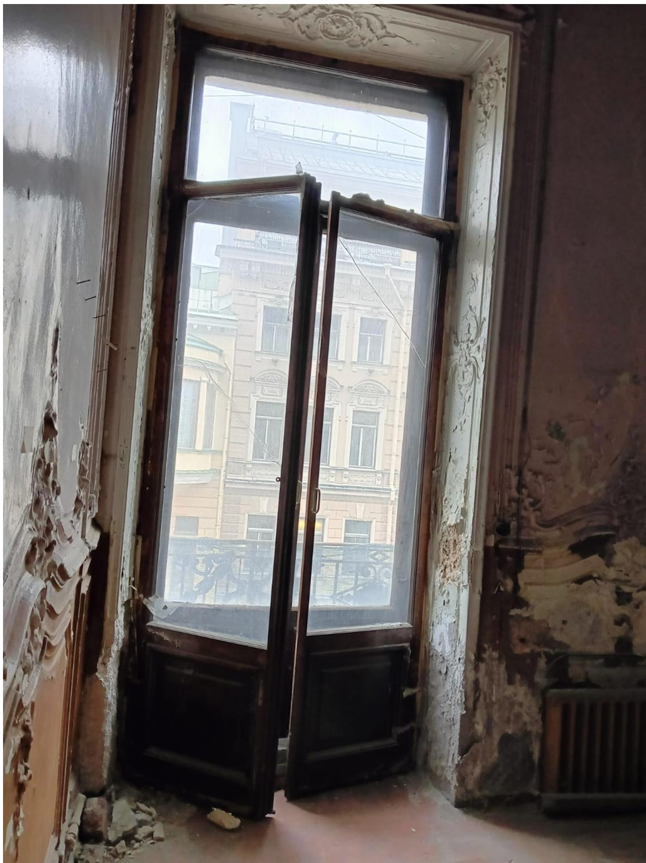
Фото 30. Фрагмент Помещения 3Н(1). Исторический балконный проем, прямоугольный, оформление (откосы с профилированными прямоугольными и криволинейными филёнками, с лепными композициями из рокайлей, С-образных и акантовых завитков, композиции по серединам сторон с круглыми розетками в центре).
