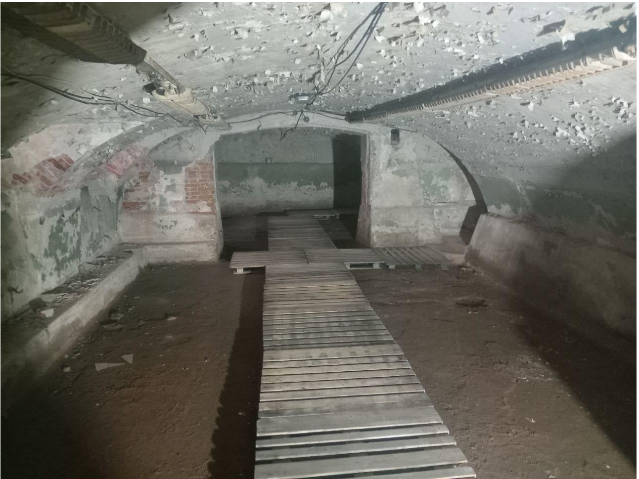
Фото 13. Общий вид пом 1Н(2) на пом 1Н(3).
