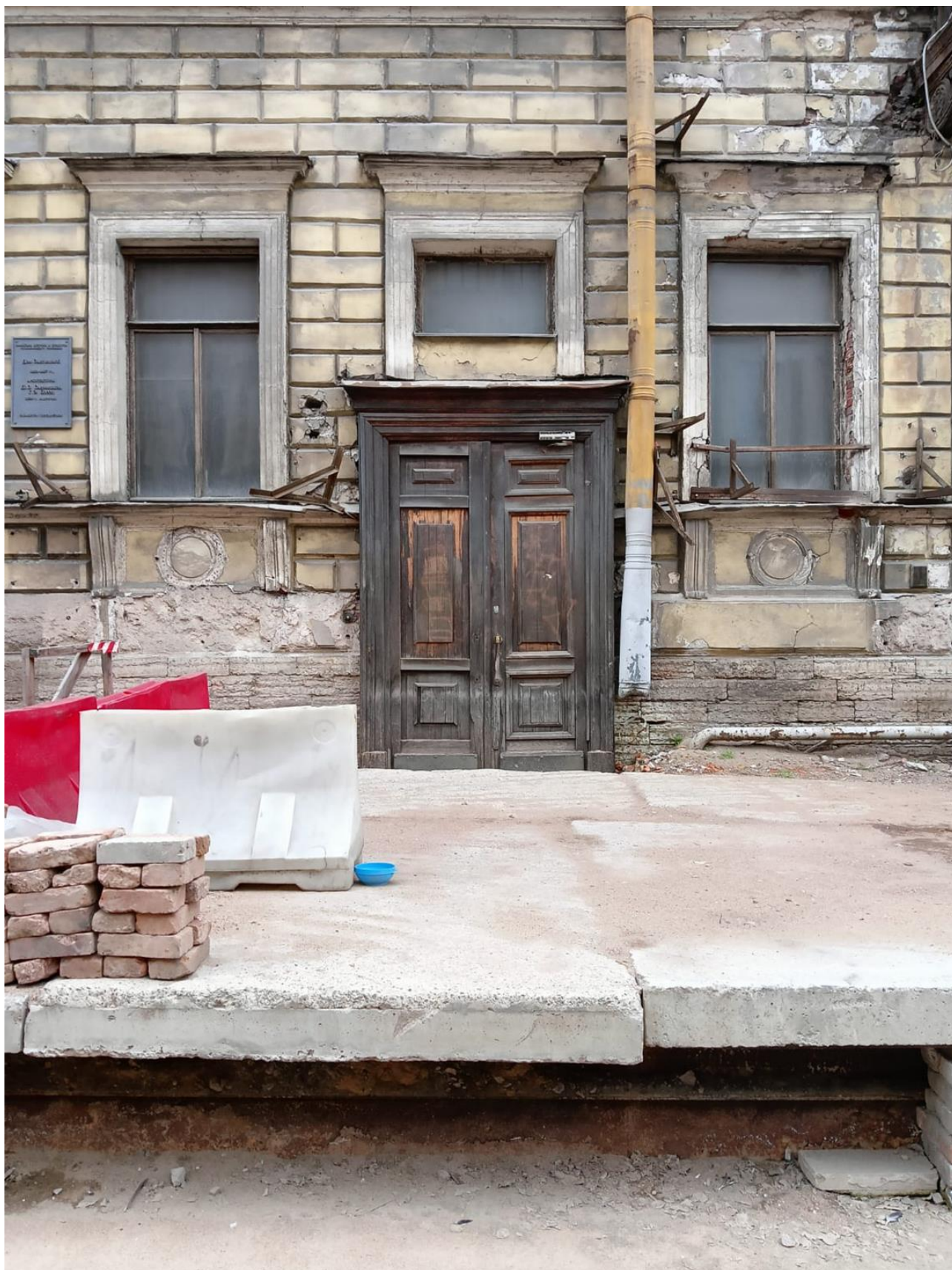
Фото 3. Фрагмент лицевого фасада. исторический дверной проем – местоположение (по 8-й световой оси), габариты, конфигурация (прямоугольный, с прямоугольным окном второго света), оформление (профилированный наличник, профилированный карниз); заполнение дверного проема – материал (дуб), конструкция (двери двухстворчатые), оформление (профилированные филенки).
