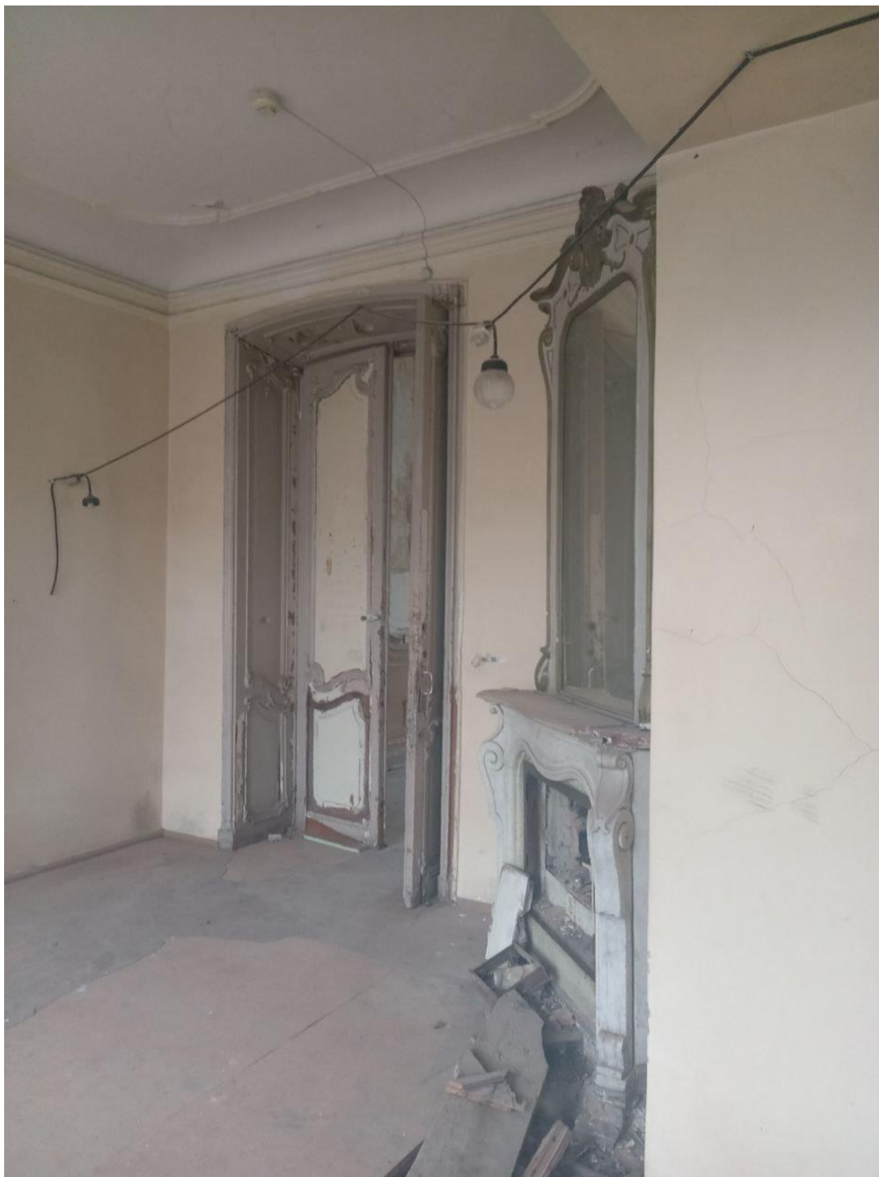
Фото 47. Помещение ЗН(12) (Передняя). Вид на пом. ЗН(9). Оформление плафона – падуга, профилированная фигурная рама со скругленными раскрепованными углами, профилированный карниз.
