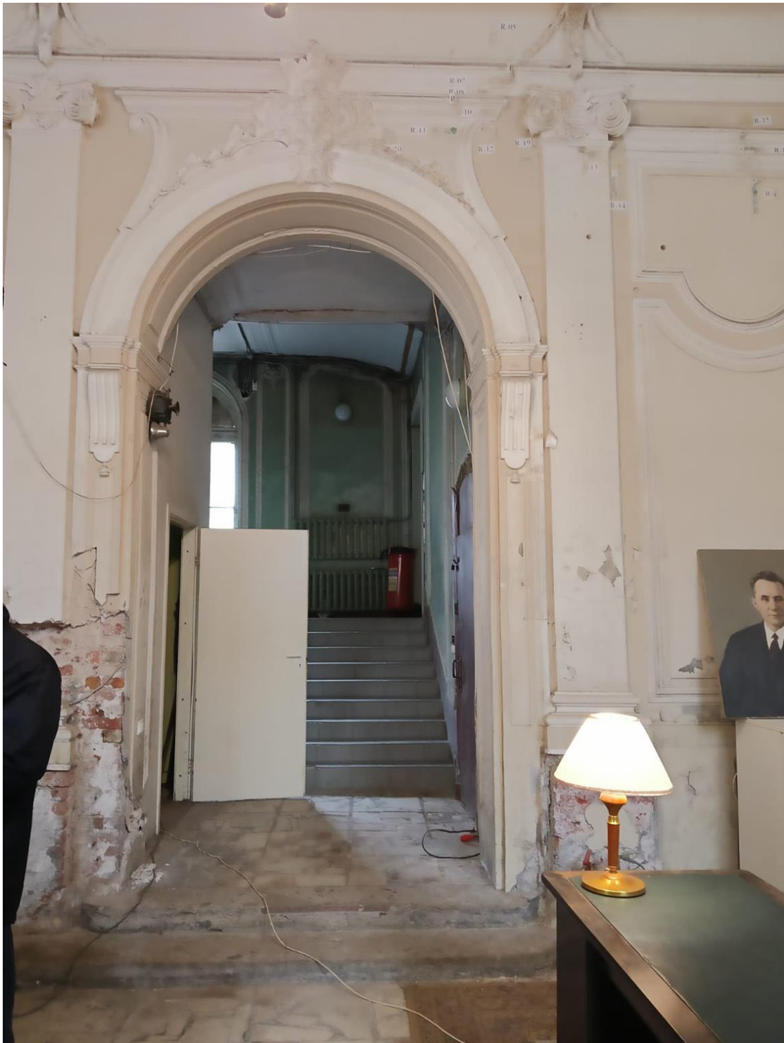
Фото 19. Фрагмент пом 1ЛК(1). Вид на пом 1ЛК(2). Оформление прохода к парадной лестнице – полуциркульная арка, в профилированном штукатурном наличнике: профилированный архивольт с замковым камнем с картушем, на импостах в виде раскрепованных филенчатых пилястр, с каннелированными консолями на капителях; над архивольтом линейный сандрик на волутообразных консолях; в центре (над замковым камнем) лепная композиция из медальона, декорированного рокайльными листьями, головкой путто в центре и двумя ниспадающими гирляндами; софит арки с профилированными филенками.
