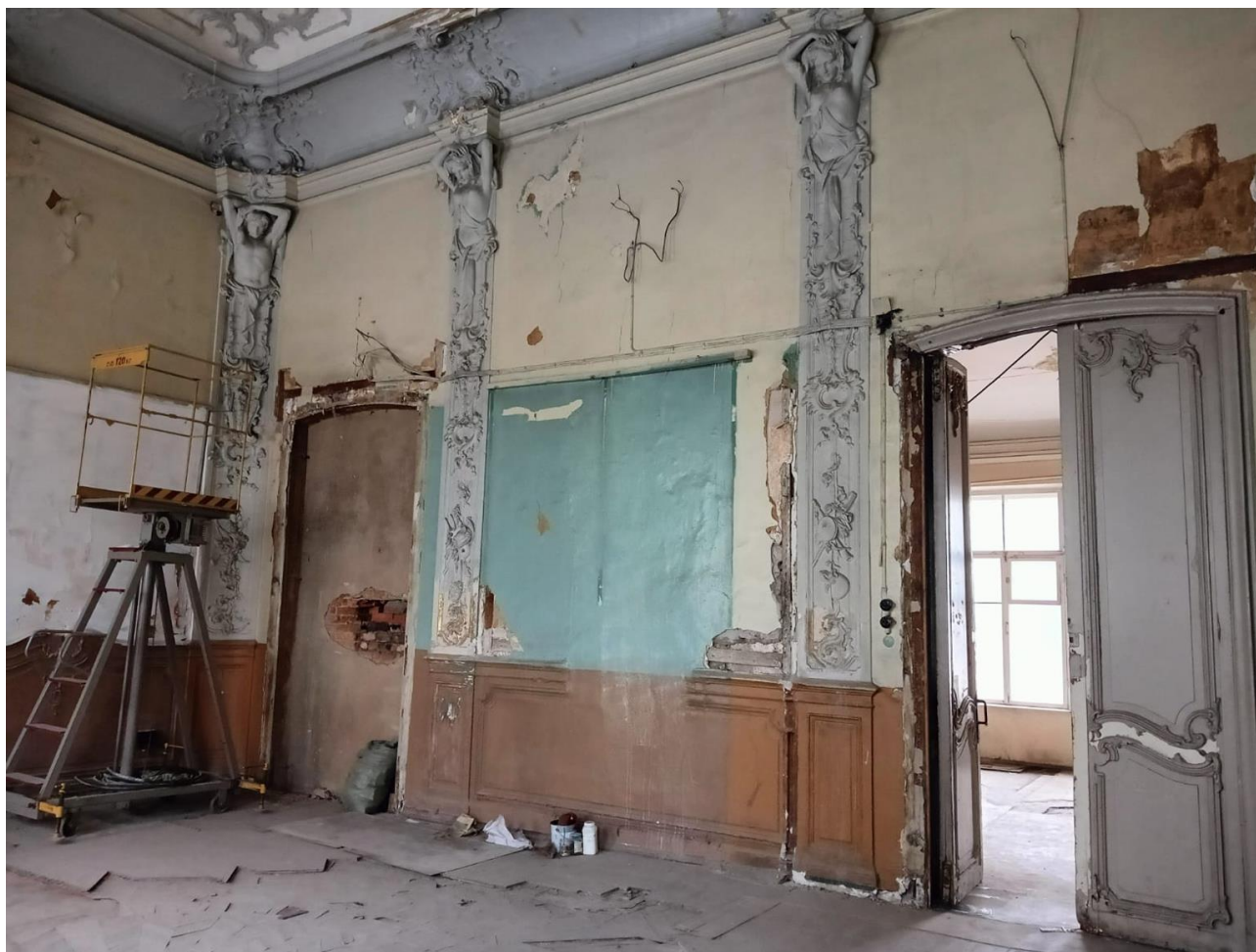
Фото 39. Помещение ЗН(9). Вид на пом. ЗН(12). оформление стен – профилированный раскрепованный карниз с большим выносом, который поддерживают восемь кариатид (по две на стене) и четыре атланта (по углам), оформленные в виде герм, декорированных лепными рокайлями и завитками, растительным орнаментом, ниспадающими фруктовыми гирляндами, лентами с бантами, перевитыми ветками роз; с золочением деталей.
