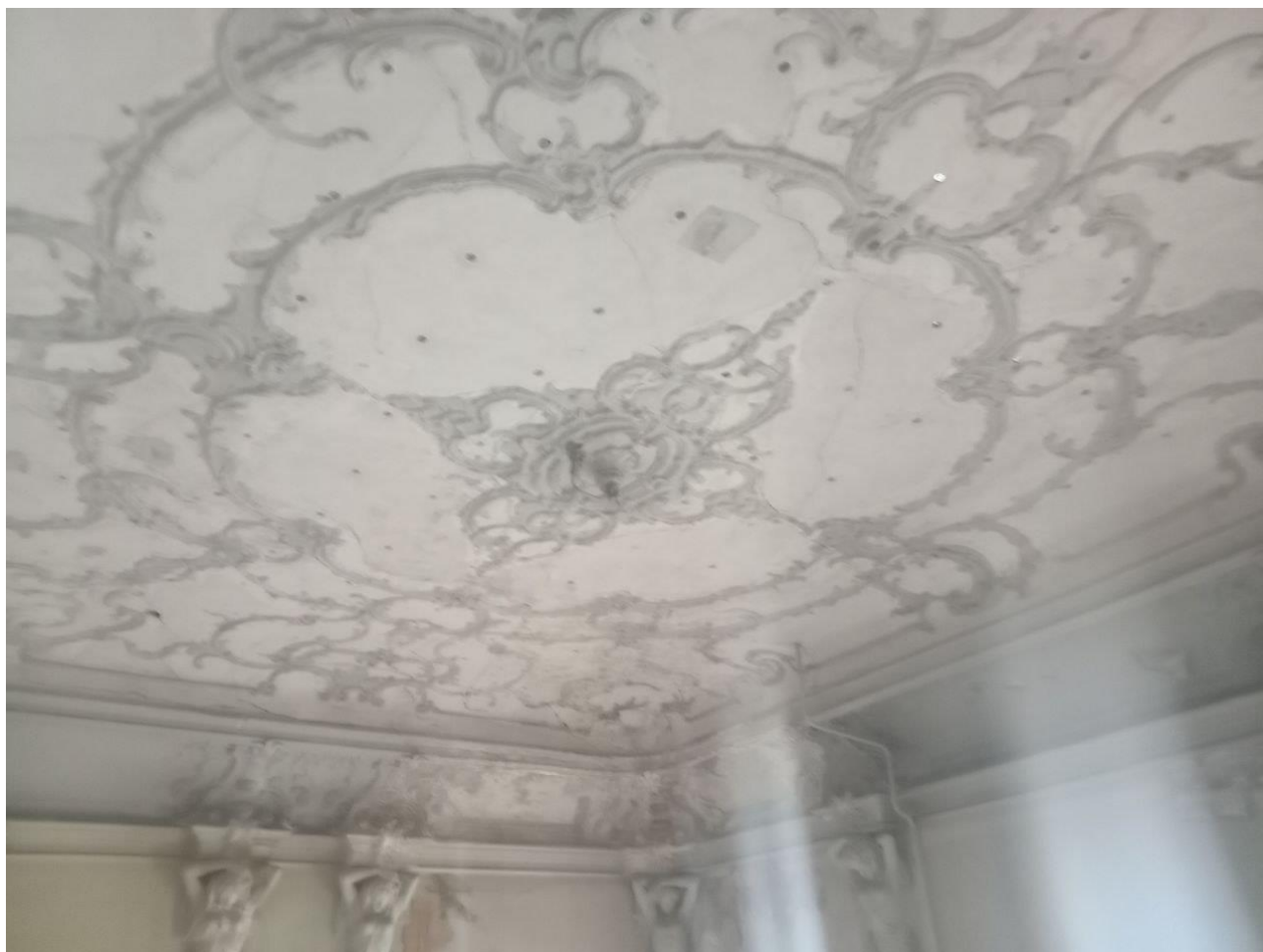
Фото 43. Помещение 3Н(9). оформление плафона – падуга сложного профиля, завершенная высокой профилированной тягой, декорированная лепными композициями (расположены над пилястрами стен) в виде картушей с медальонами, увенчанными трилистником.
