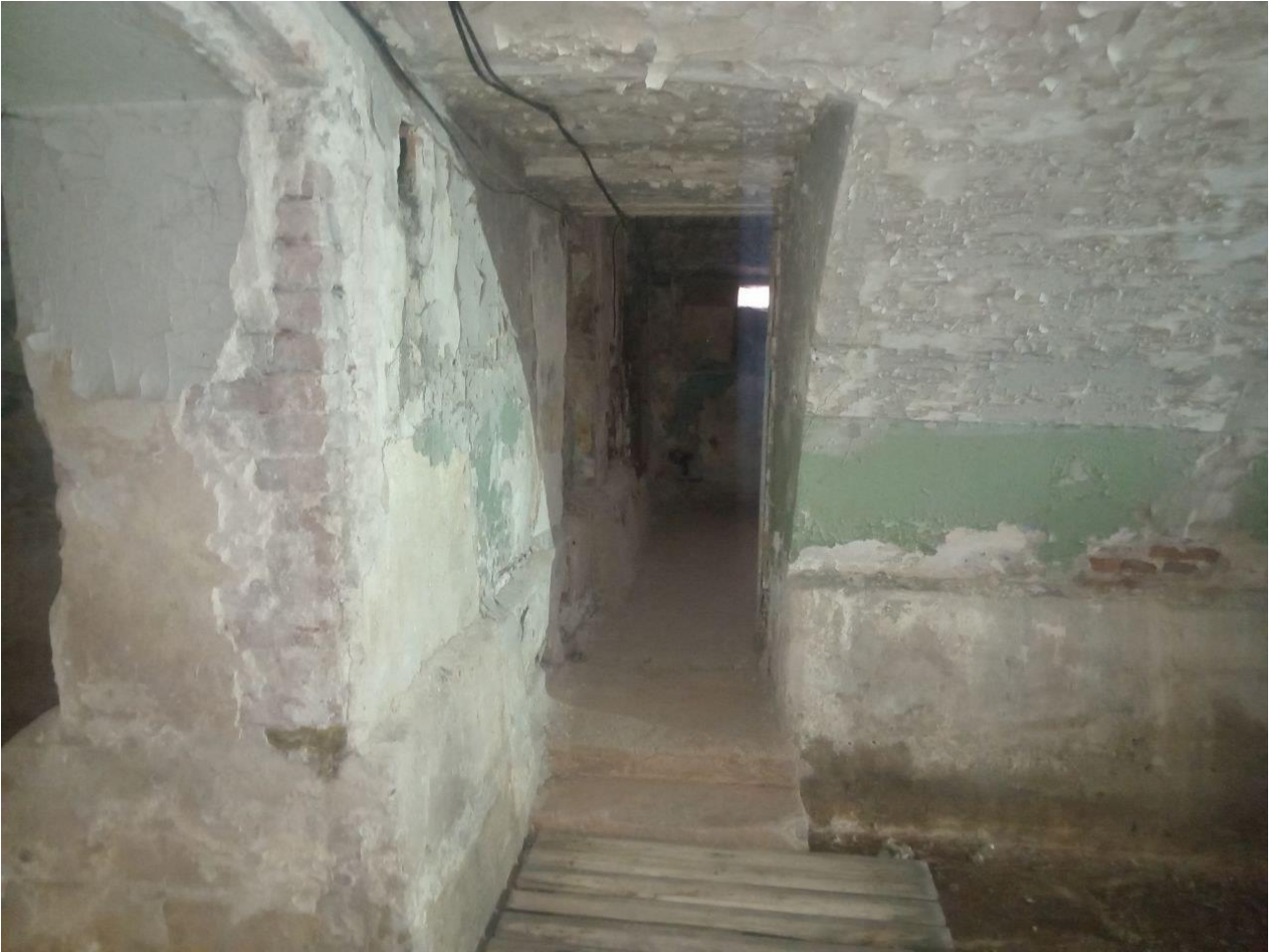
Фото 14. Фрагмент пом 1Н(2). Вид на вход в пом. 1Н(13).
