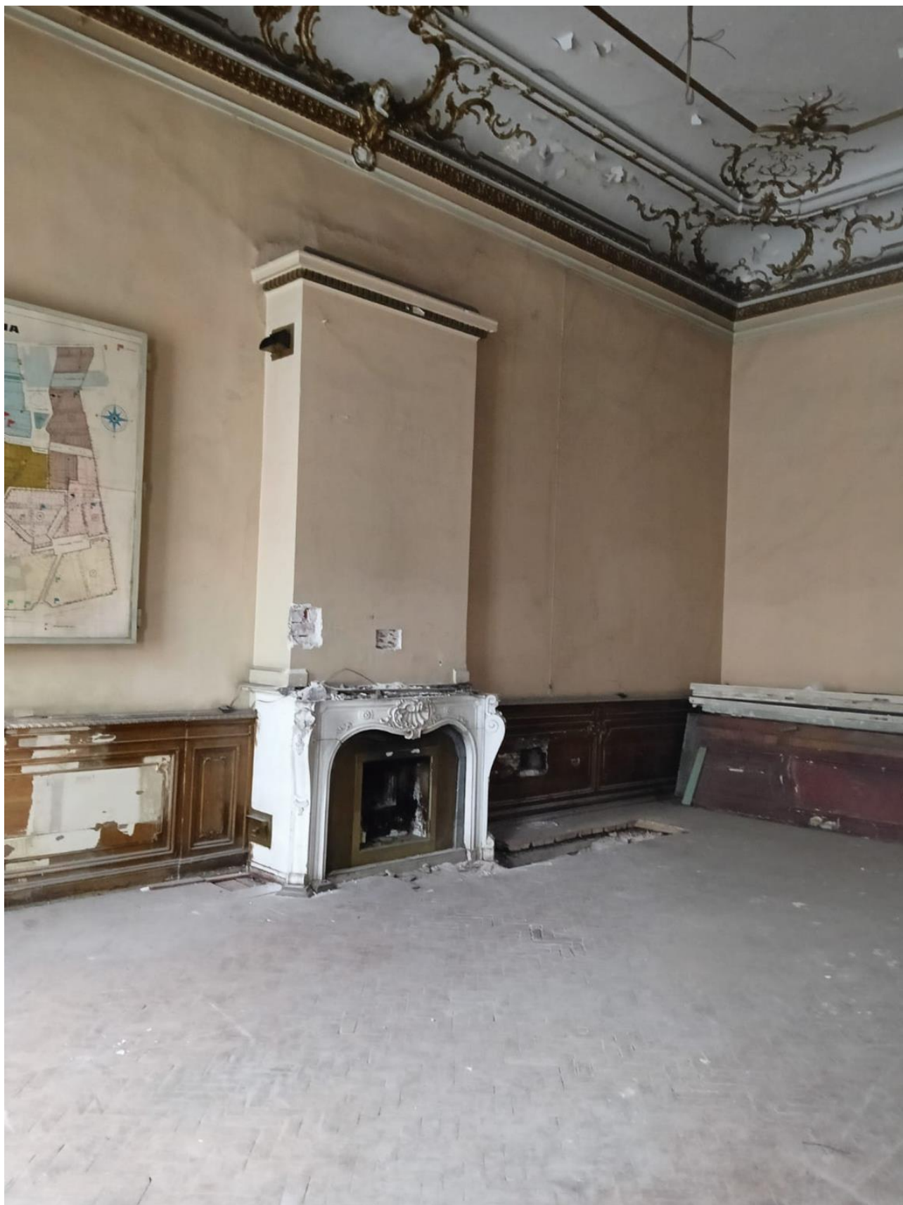
Фото 44. Помещение ЗН(10) (Большой кабинет). Общий вид. Печь-камин – средистенная, двухъярусная; нижний ярус: белого мрамора; нижний ярус с отделкой из гладкой оштукатуки, увенчан профилированным карнизом.
