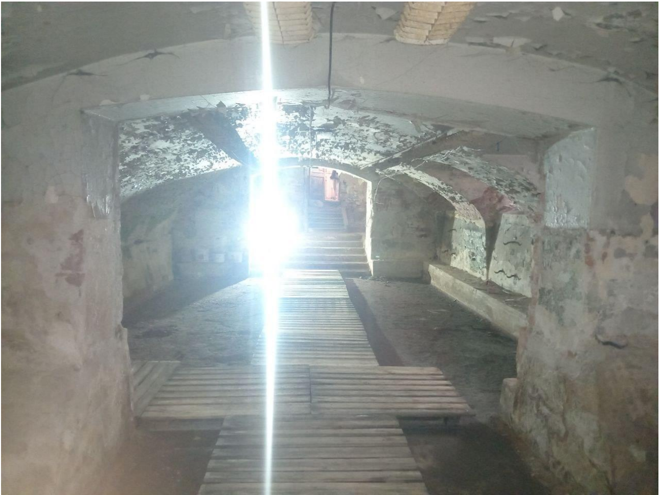
Фото 12. Общий вид пом 1Н(2) на пом 2(Н). своды подвального и первого этажей лицевого флигеля (коробовые с распалубками).
