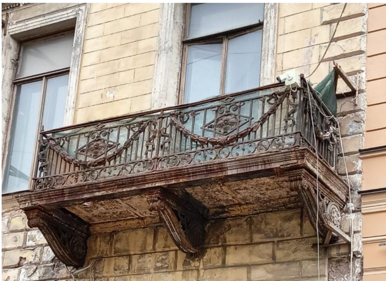
Фото 4. Прямоугольный балкон (по 10-й световой оси, в уровне 2-го этажа),украшенный чугунным обломом на чугунных каннелированных кронштейнах, декорированных розетками и листом аканта , Кованая ограда балкона состоит из двух секций; боковые секции продолжают мотив лицевой решётки. Каждая секция оформлена чугунным фестонном, охватывающим центральную розетку, вписанную в горизонтальный ромб. Снизу секция завершена фризом из чередующихся полуколец и колец с розетками, сверху — венчающим поясом, образованным импостами по краям и ромбами в центральной части секций. две водосборные трубы оформлены в виде змеиных голов расположенных на нижней плоскости балкона по центру секций.
