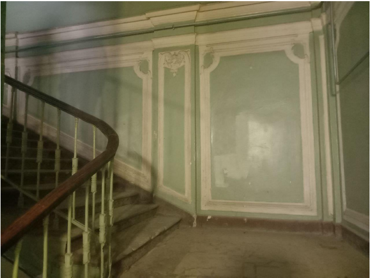
Фото 22. ЛК(1) Марш до площадки 2 этажа. Общий вид.
