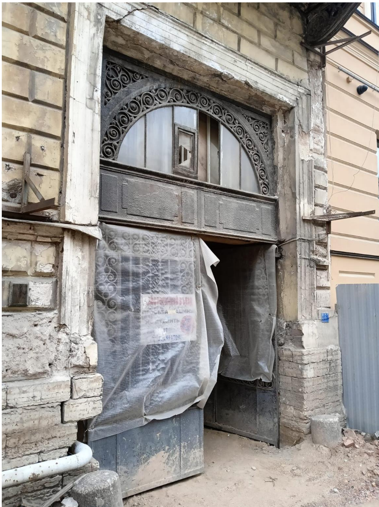
Фото 5. Фрагмент лицевого фасада. Воротный проезд по 10 световой оси. Заполнение воротного проема – материал (металл), конструкция (ворота двухстворчатые, с прямоугольной фрамугой, с полуциркульным остеклением), оформление (ажурные фризы из волнообразных завитков, филенчатый фриз над воротами). По сторонам от воротного проезда колесоотбойные тумбы из овоидального гранита (рапакиви).
