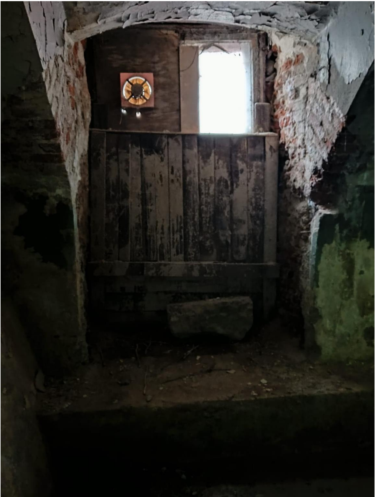
Фото 15. Фрагмент пом 1Н(3).
