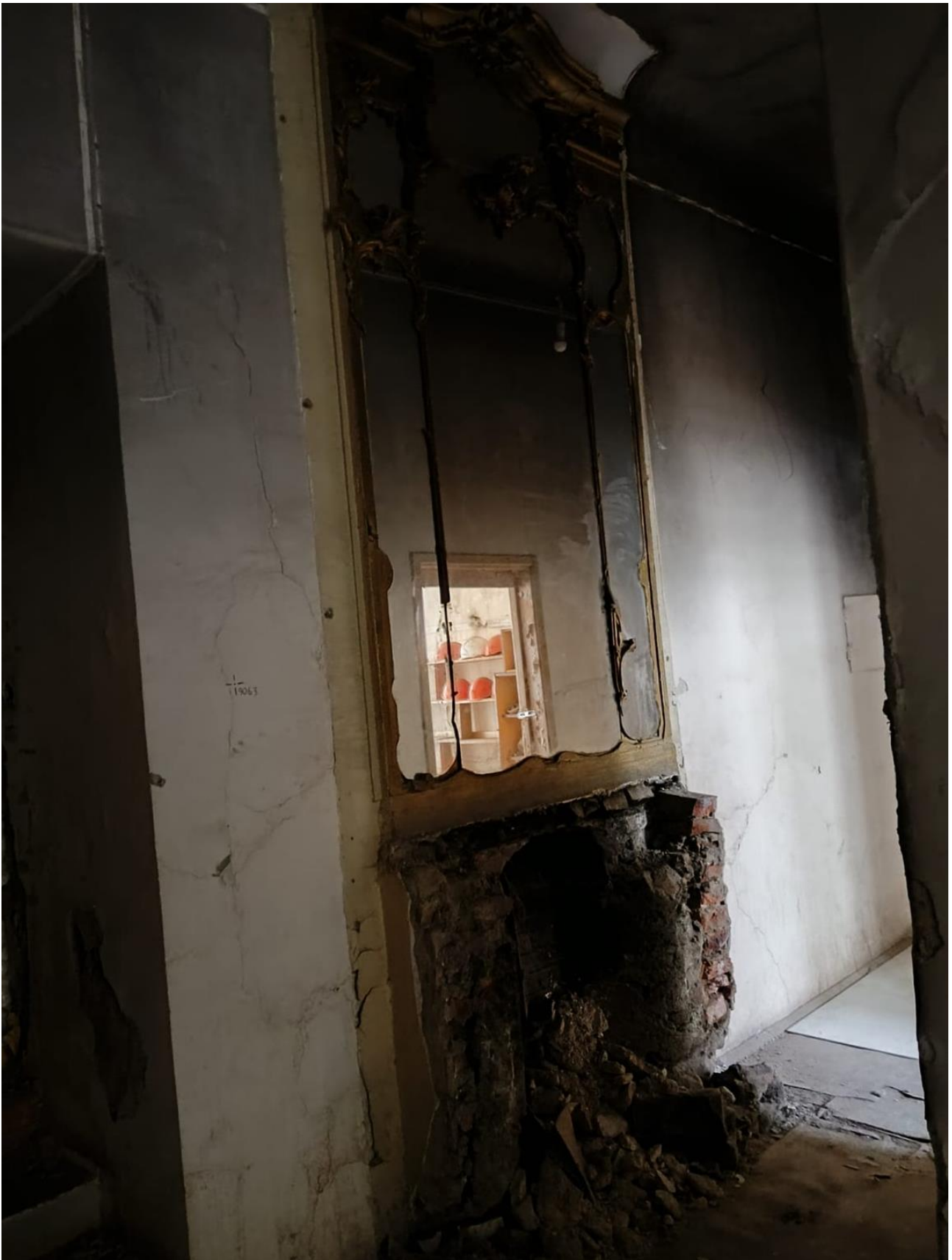
Фото 51. Помещение 3Н (13) (Малый (Зеркальный) кабинет).камин средистенный. Двухярусный. Нижний ярус утрачен, верхний ярус: надкаминное зеркало в деревянной фигурной резной золоченой раме.
