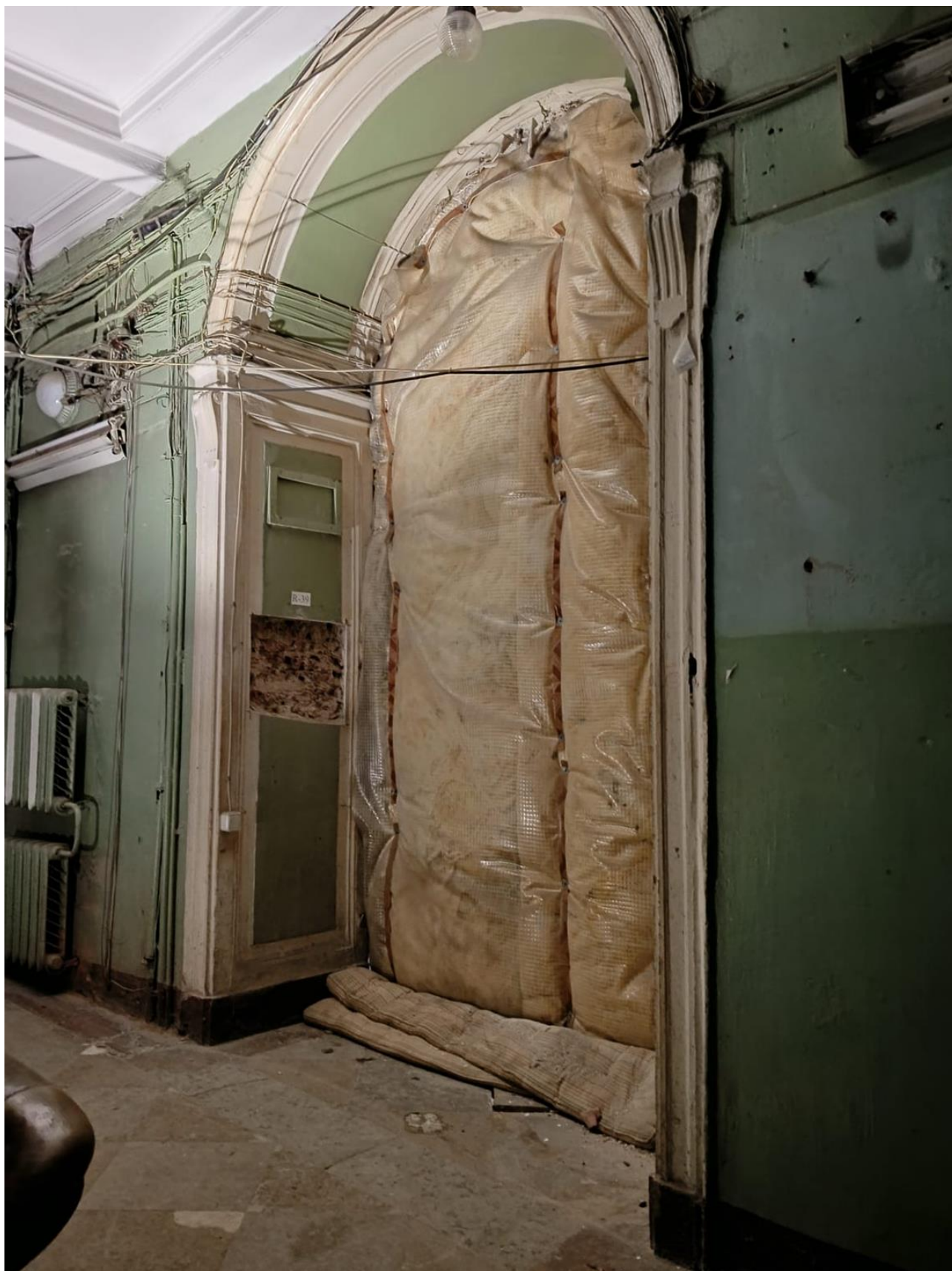
Фото 26. Помещение 1ЛК(5). Площадка 2 этажа. Оформление эркера: проем на парадную лестницу лицевого корпуса – полуциркульная арка, с профилированными архивольтами на импостах в виде филенчатых пилястр.
