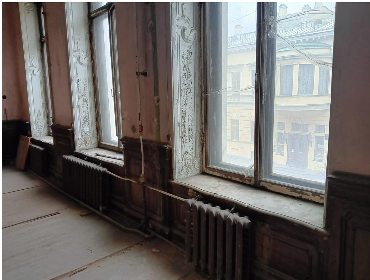
Фото 35. Помещение 3Н(8). исторические оконные проемы прямоугольные, откосы с профилированными прямоугольными и криволинейными филенками, с лепными композициями из рокайлей, с-образных и акантовых завитков, композиции по серединам сторон с круглыми розетками в центре); заполнение оконных проемов – дуб, рамы двойные, двустворчатые, с глухой прямоугольной фрамугой; доска подоконная – белого с серыми прожилками мрамора, криволинейного очертания, с профилированным краем; мастерская Мадерни; 1846-1847 гг.; размер: длина – 176 см; ширина – 41 см.
