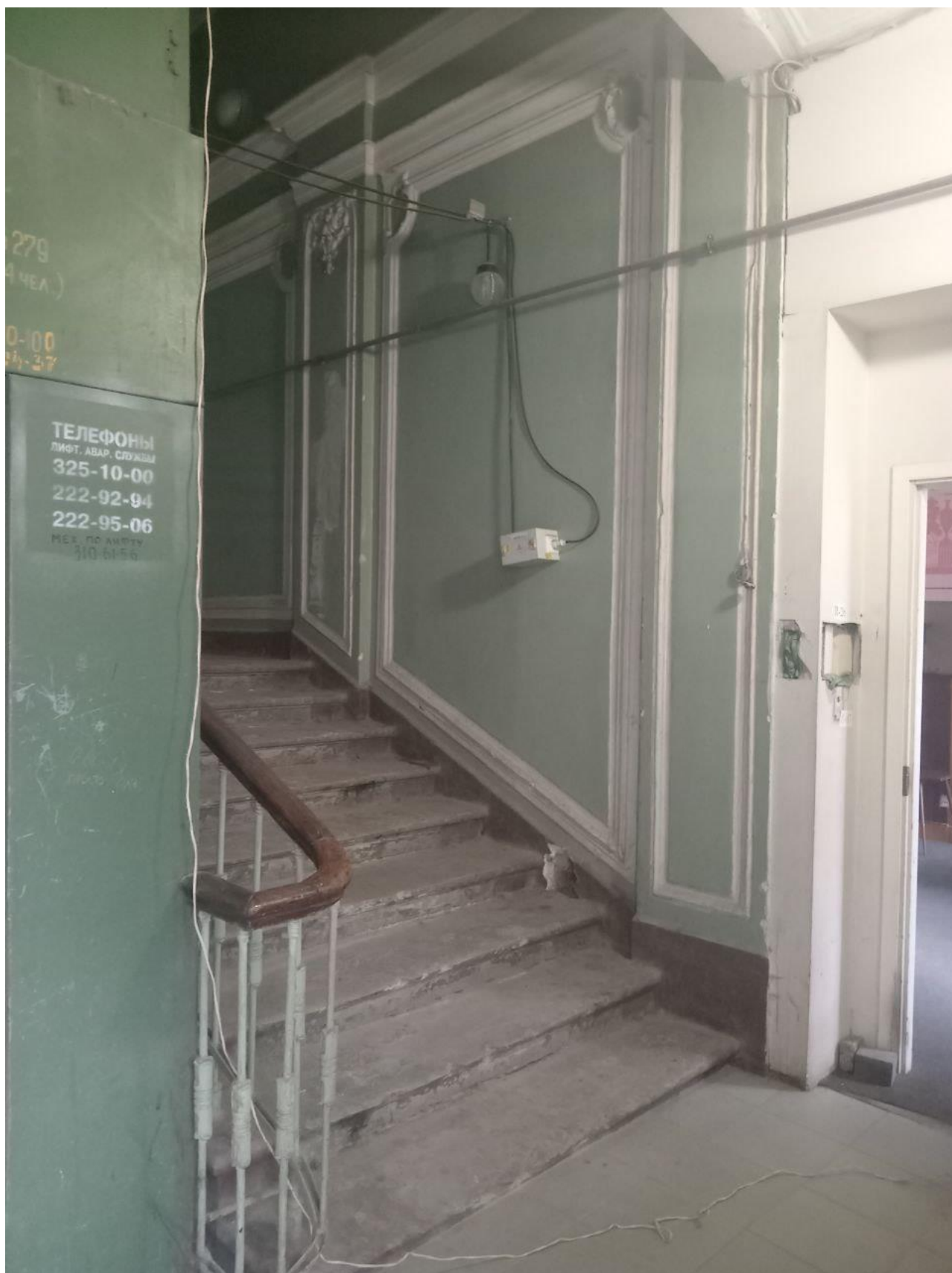
Фото 21. ЛК(1) Марш до площадки между 1 и 2 этажом. Оформление стен – в нижней половине штукатурные филенчатые пилястры, соединенные в уровне капителей профилированным карнизом.
