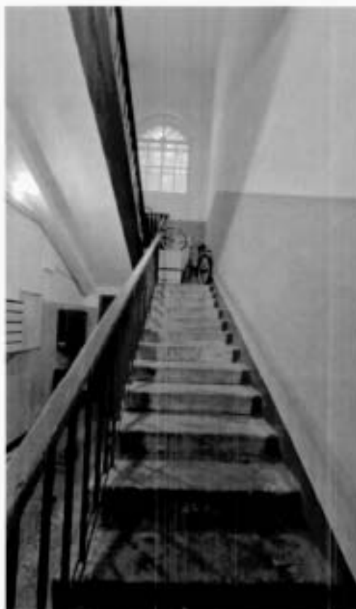
5. Лестница 3-ЛК (Фотография от 19.07.2024).
