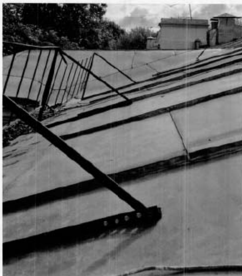
28. Кровля (Фотография от 19.07.2024).
