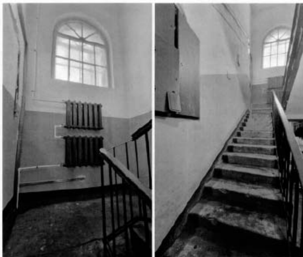
14, 15. Лестница 2-ЛК (Фотографии от 19.07.2024).
