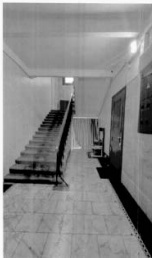
6. Лестница 4-ЛК (Фотография от 19.07.2024).
