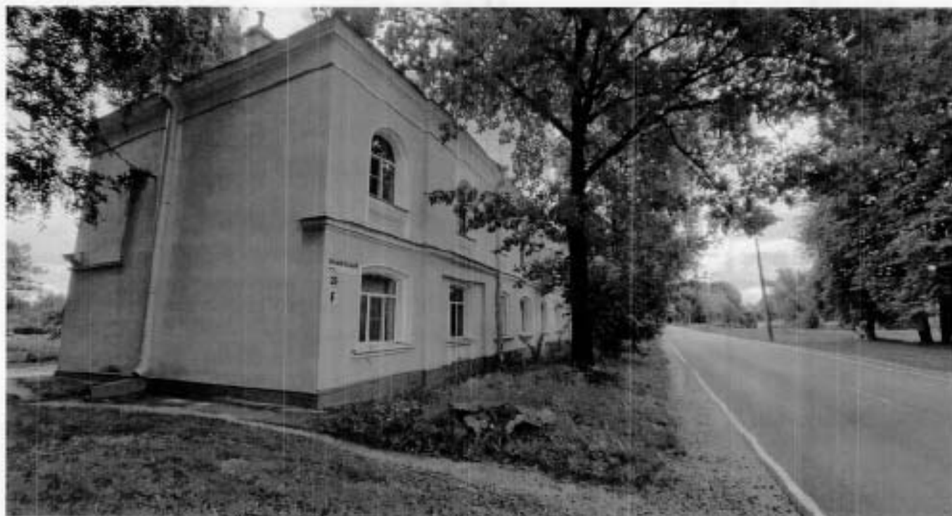
1. Лицевой фасад части объекта культурного наследия (флигель) (Фотография от 19.07.2024).
