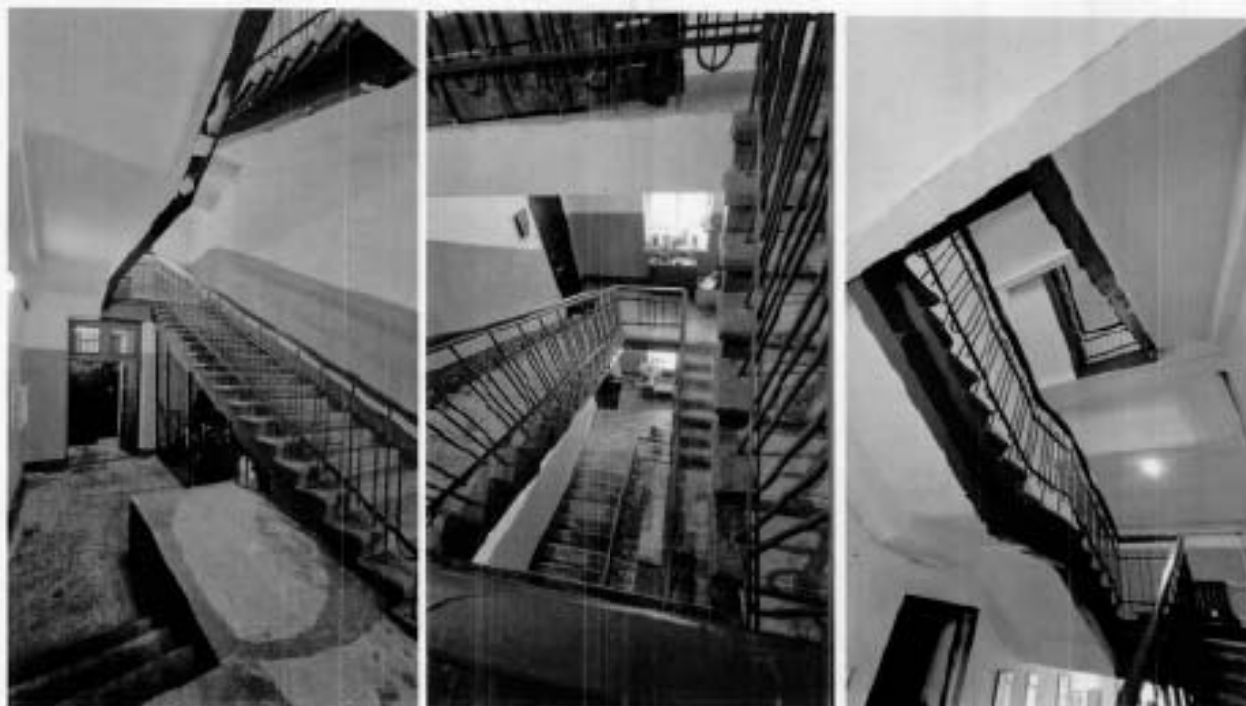
11, 12, 13. Лестница 1-ЛК (Фотографии от 19.07.2024).
