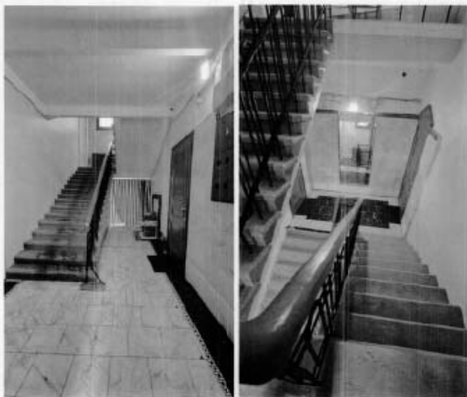
18, 19. Лестница 4-ЛК (Фотографии от 19.07.2024).
