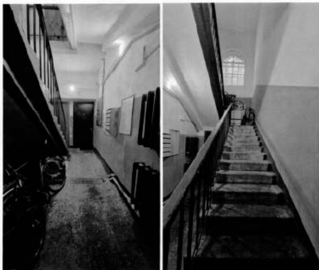
16, 17. Лестница 3-ЛК (Фотографии от 19.07.2024).
