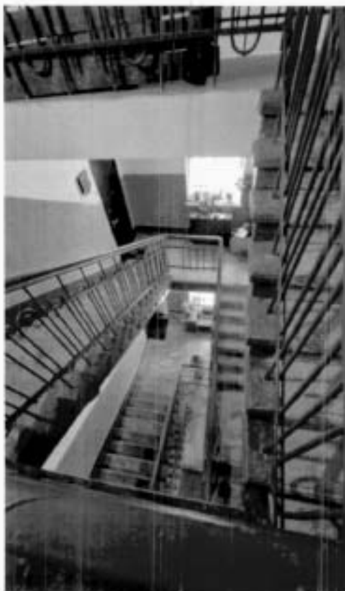
3. Лестница 1-ЛК (Фотография от 19.07.2024).
