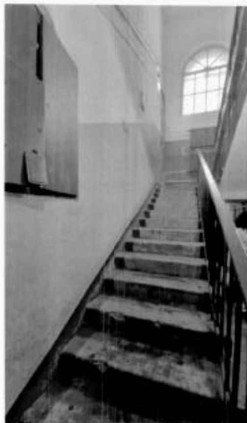
4. Лестница 2-ЛК (Фотография от 19.07.2024).
