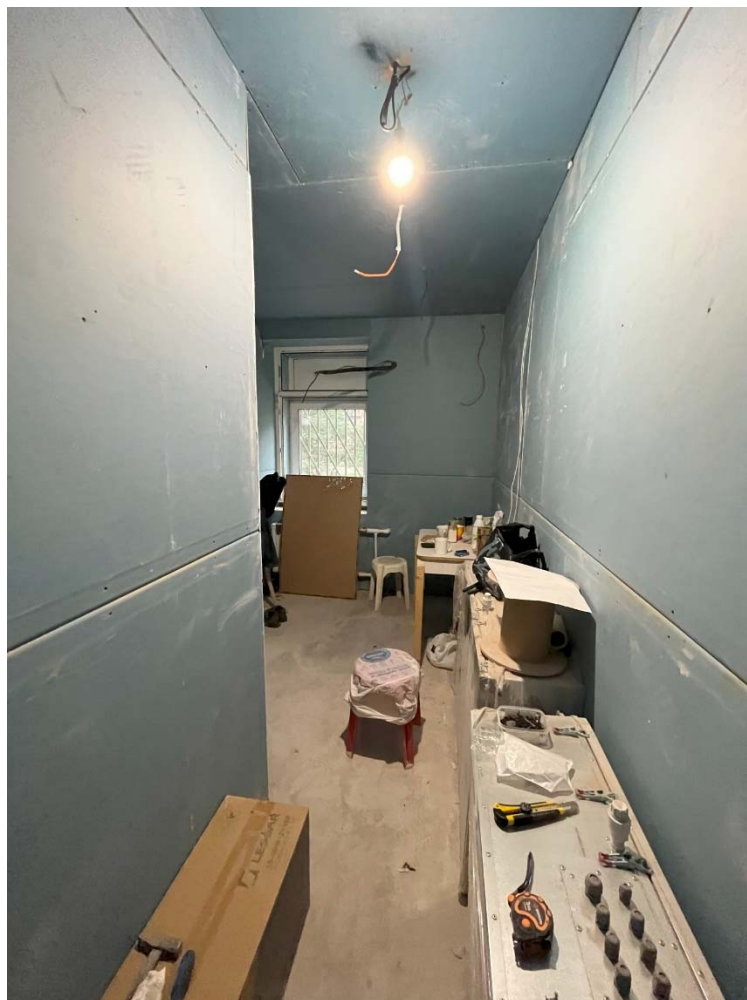
Фото №31. Помещение 7-Н (9).
