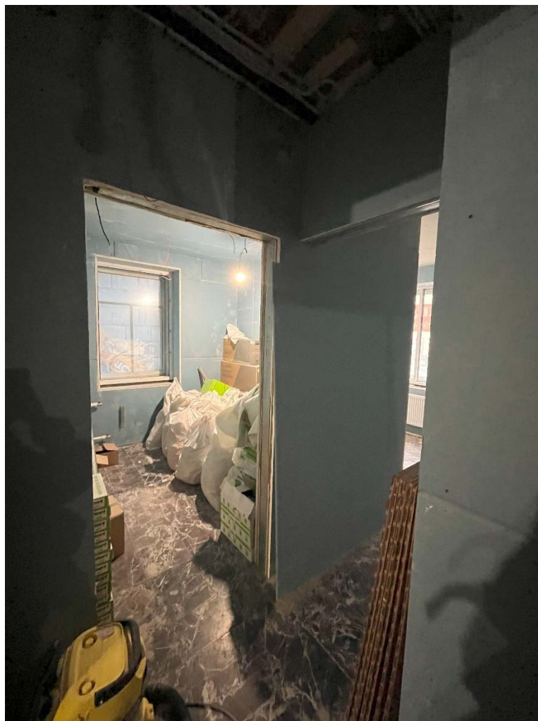
Фото №18. Помещение 7-Н (7).
