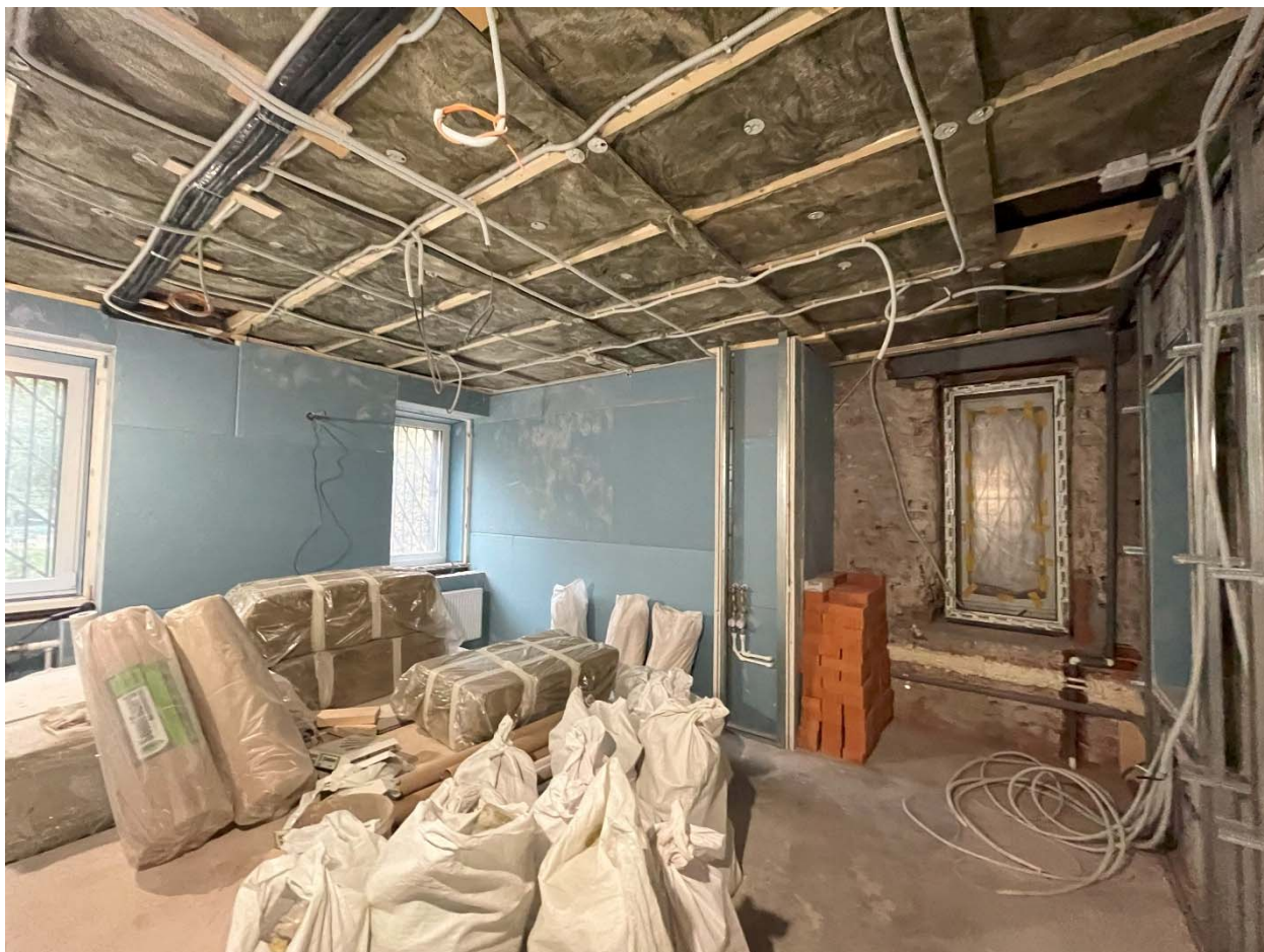
Фото №24. Помещение 7-Н (11).
