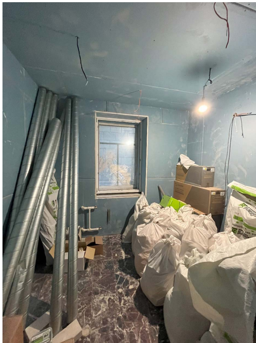
Фото №19. Помещение 7-Н (12).
