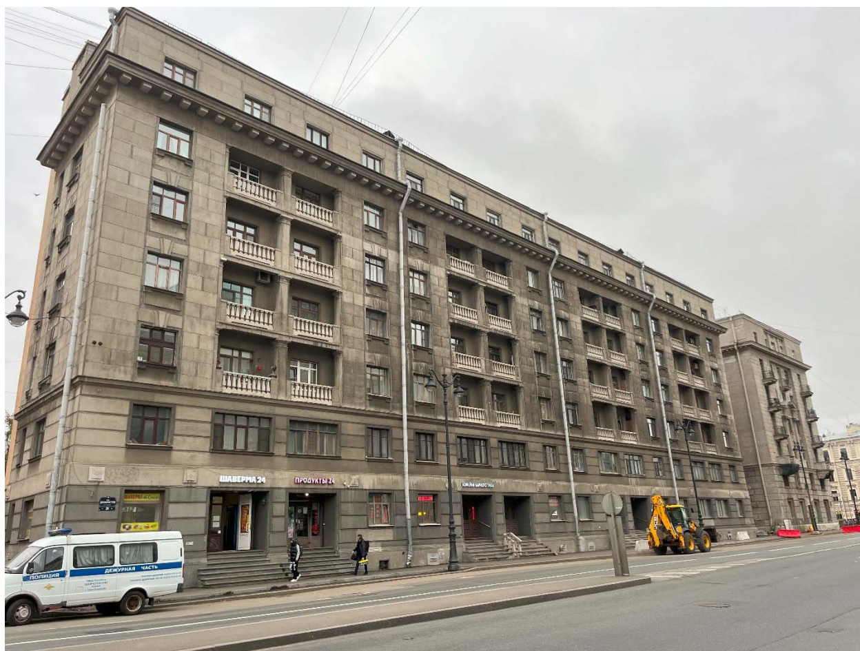
Фото №1. Лицевой фасад по улице Декабристов.
