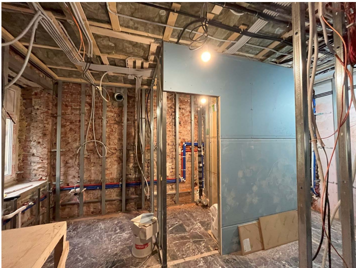
Фото №29. Помещение 7-Н (3).
