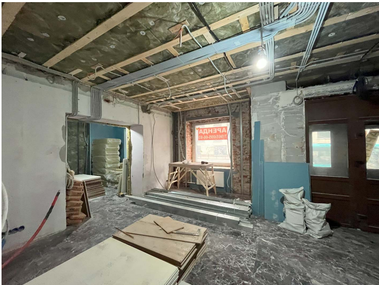
Фото №26. Помещение 7-Н (2, 16).
