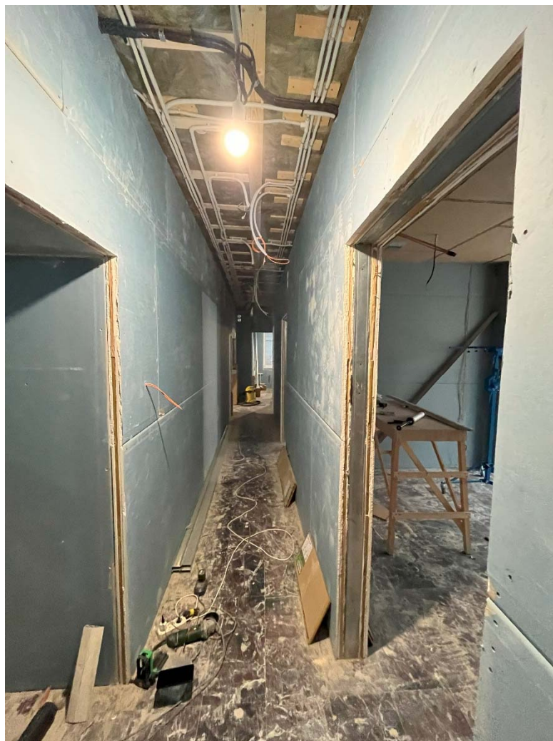
Фото №13. Помещение 7-Н (7).
