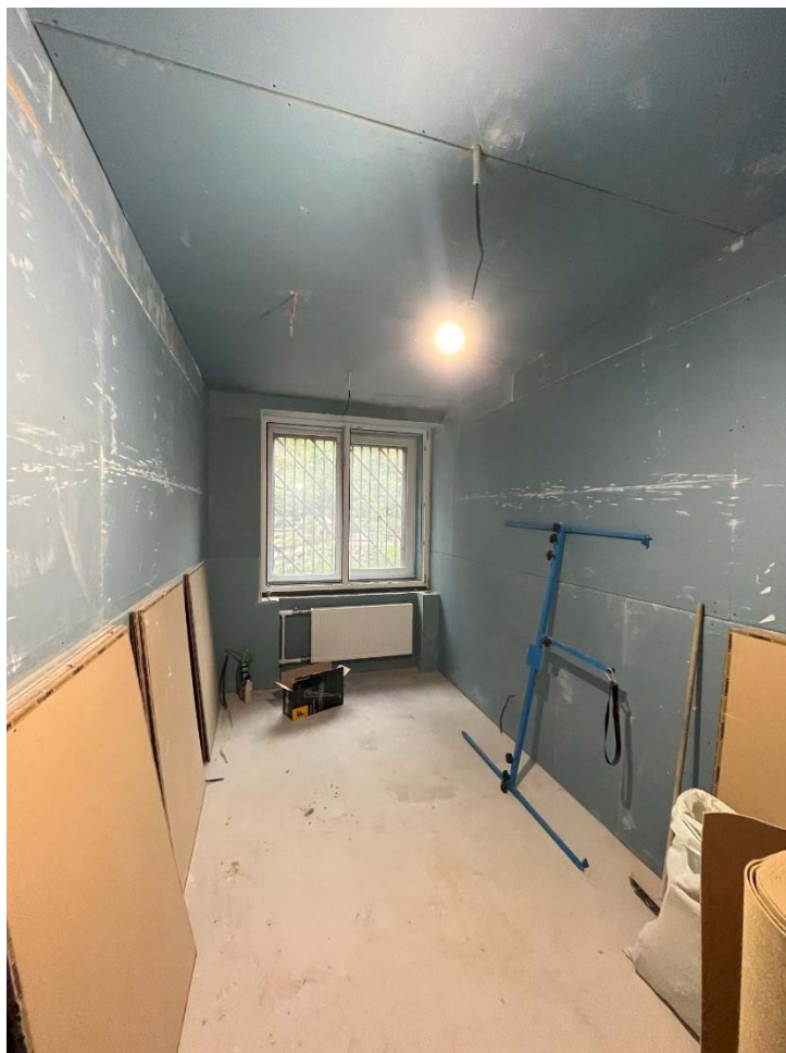
Фото №32. Помещение 7-Н (10).
