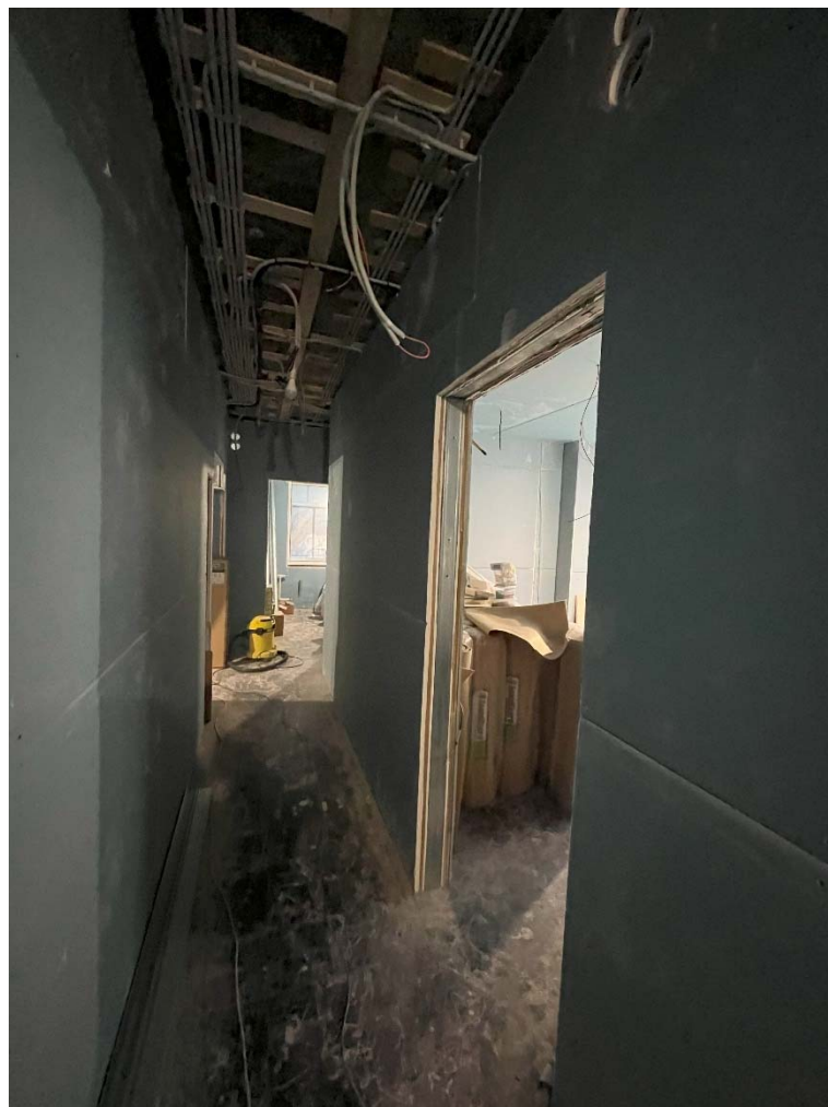
Фото №15. Помещение 7-Н (7).
