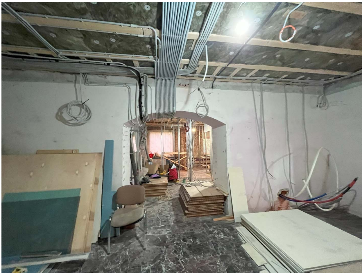
Фото №27. Помещение 7-Н (2, 16).
