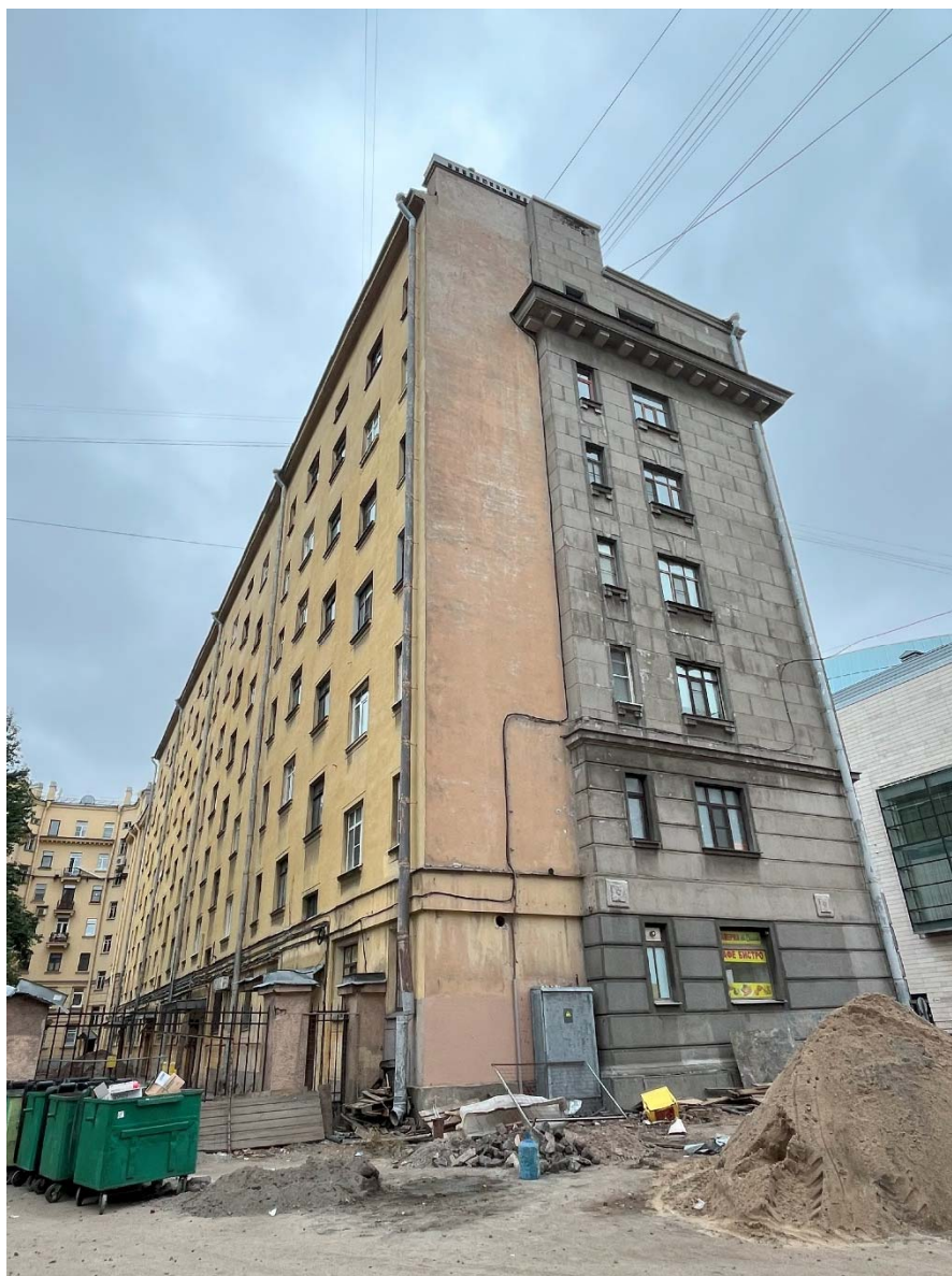
Фото №2. Торцевой фасад.
