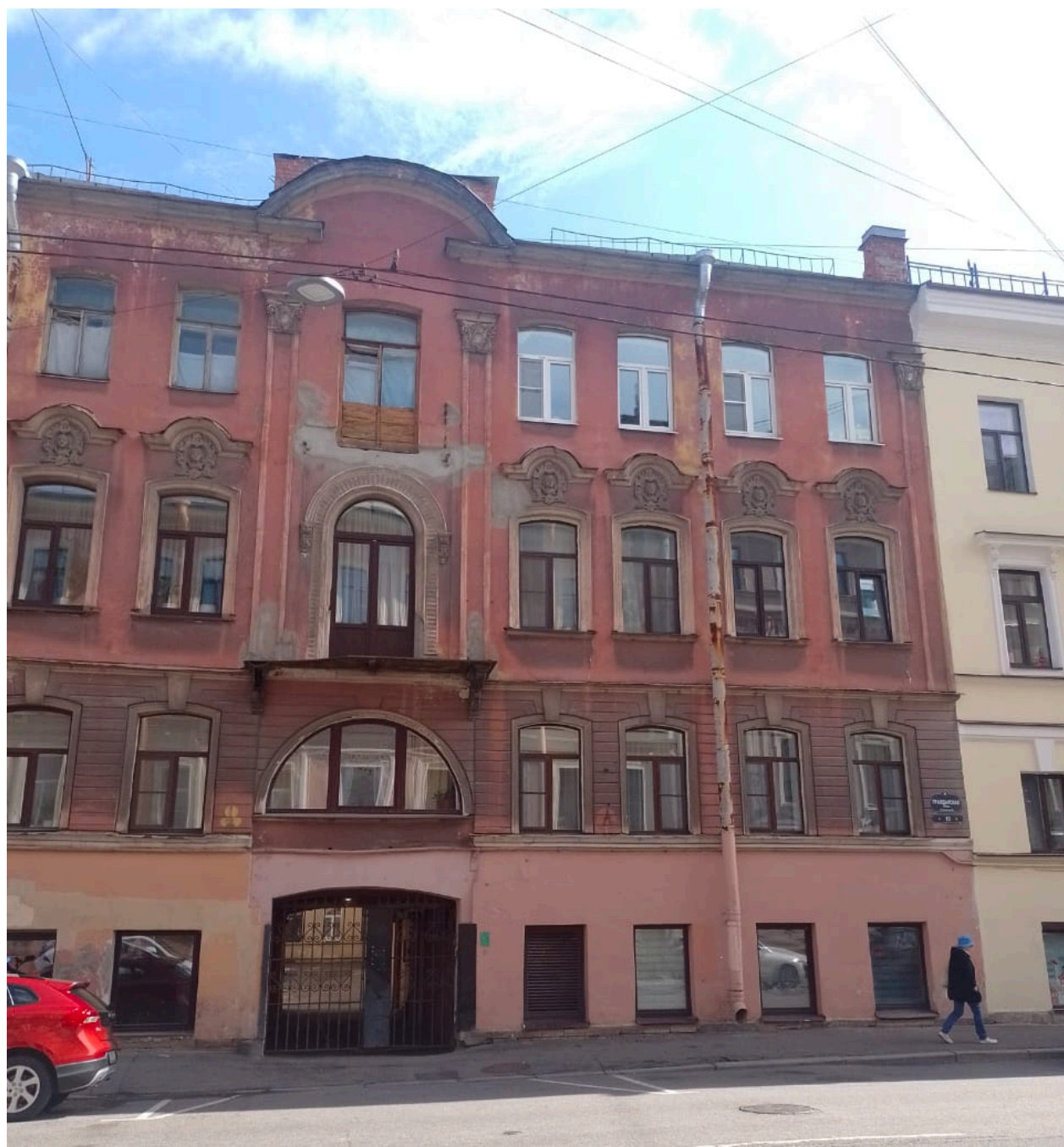
3. «Дом Миллера В.» Санкт-Петербург, Гражданская ул., 10, литера А. Фрагмент лицевого фасада. Правая часть. Фото: 30.06.2025.
