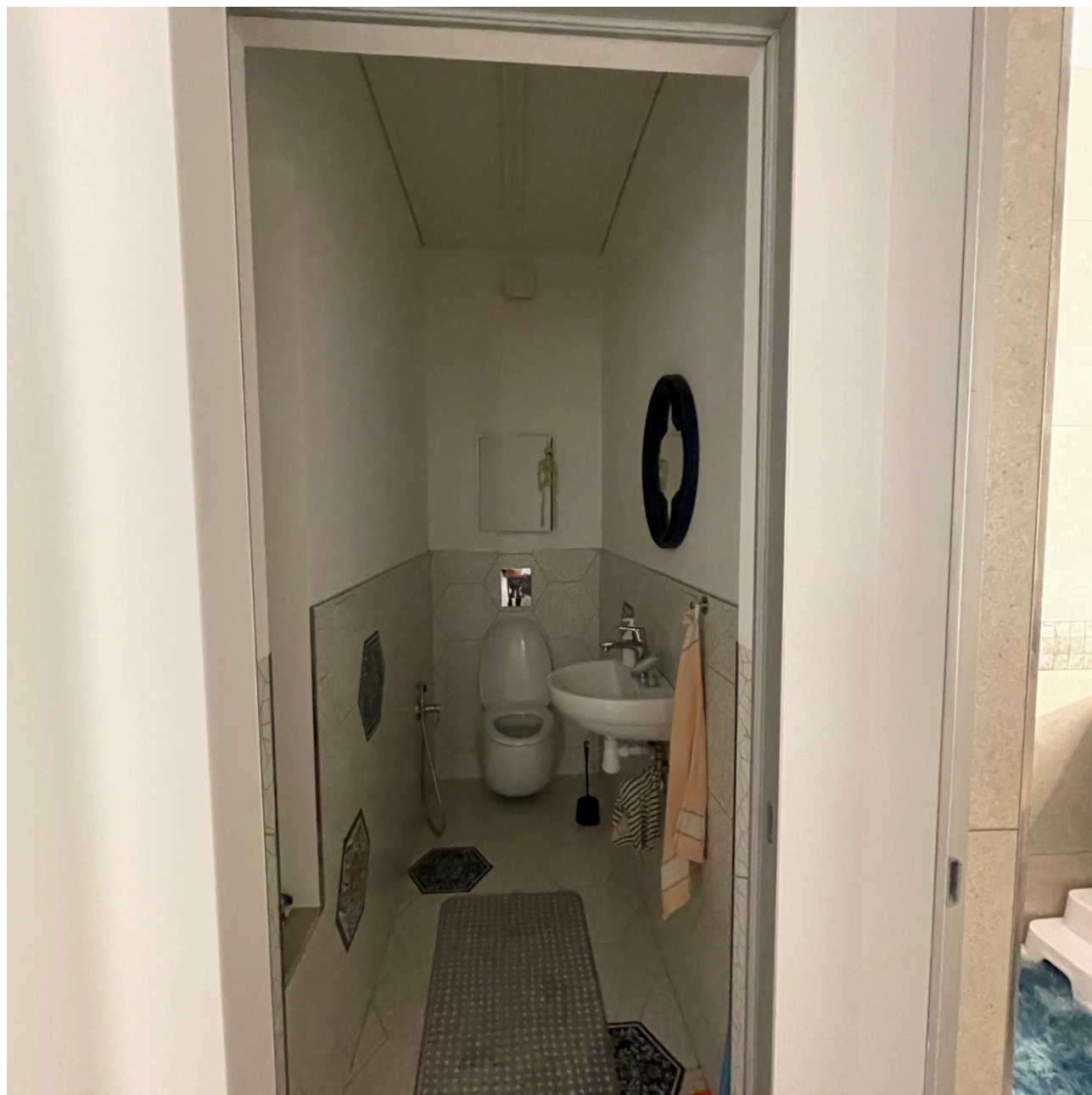
14. «Дом Миллера В.» Санкт-Петербург, Гражданская ул., 10, литера А. Фрагмент пом. кв.№ 23 (10). Фото: 30.06.2025.
