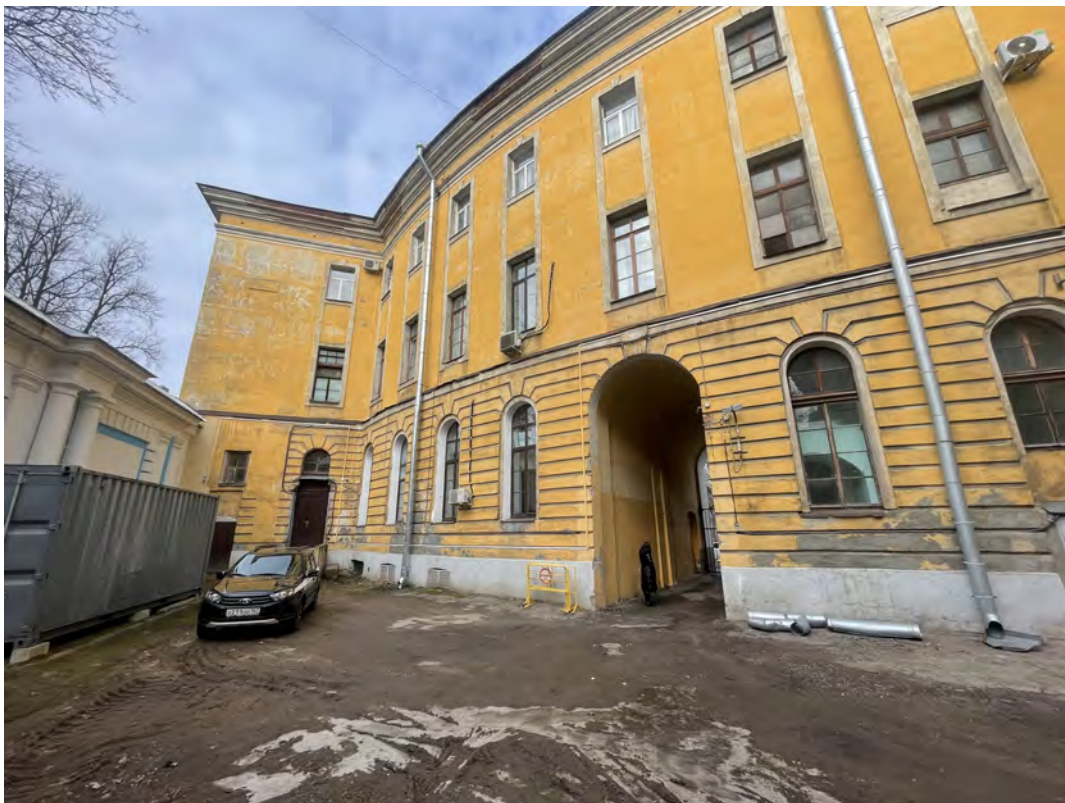
8. Вид на западный корпус и внутренний двор объекта культурного наследия федерального значения «Главное здание», расположенного по адресу: г. Санкт-Петербург, ул. Смольного, дом 3, литера А (Смоленого ул. 3), входящего в состав ансамбля «Институт Александровский» (Смольного ул.,3, Смольная наб.);
