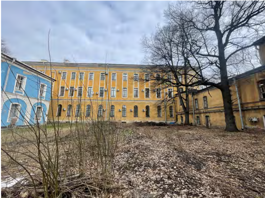
15. Вид на западный корпус и внутренний двор объекта культурного наследия федерального значения «Главное здание», расположенного по адресу: г. Санкт-Петербург, ул. Смольного, дом 3, литера А (Смоленого ул. 3), входящего в состав ансамбля «Институт Александровский» (Смольного ул.,3, Смольная наб.) и Смольный собор;
