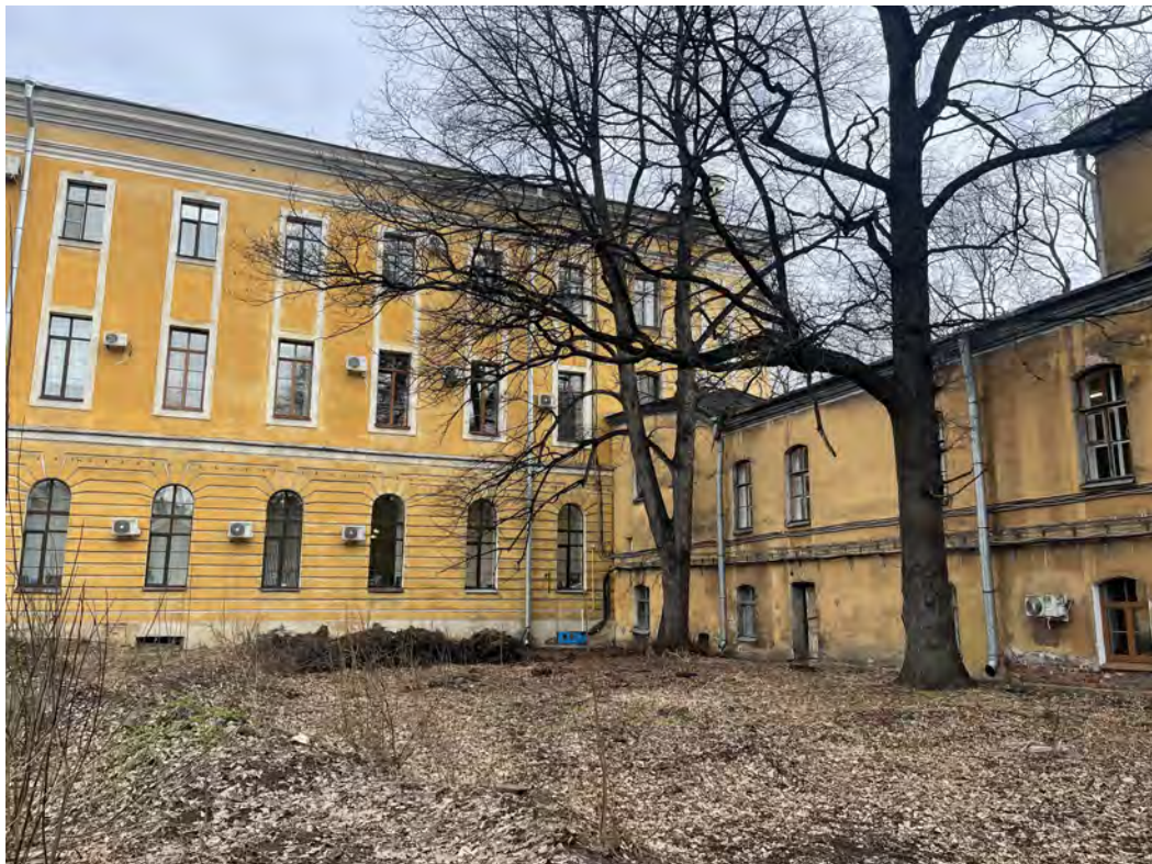
16. Вид на западный корпус и внутренний двор объекта культурного наследия федерального значения «Главное здание», расположенного по адресу: г. Санкт-Петербург, ул. Смольного, дом 3, литера А (Смоленого ул. 3), входящего в состав ансамбля «Институт Александровский» (Смольного ул.,3, Смольная наб.) и Смольный собор;
