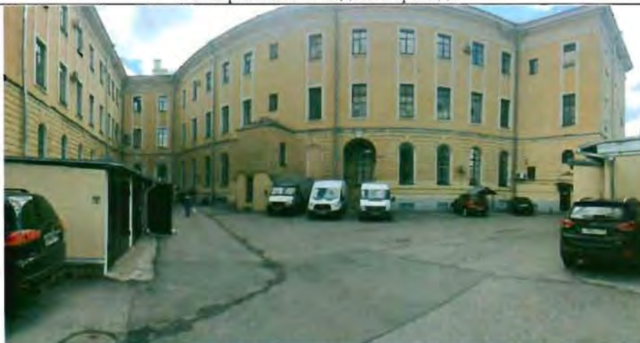
2. Фрагмент северного фасада
