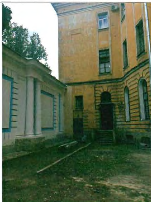
5. Фрагмент южного фасада
