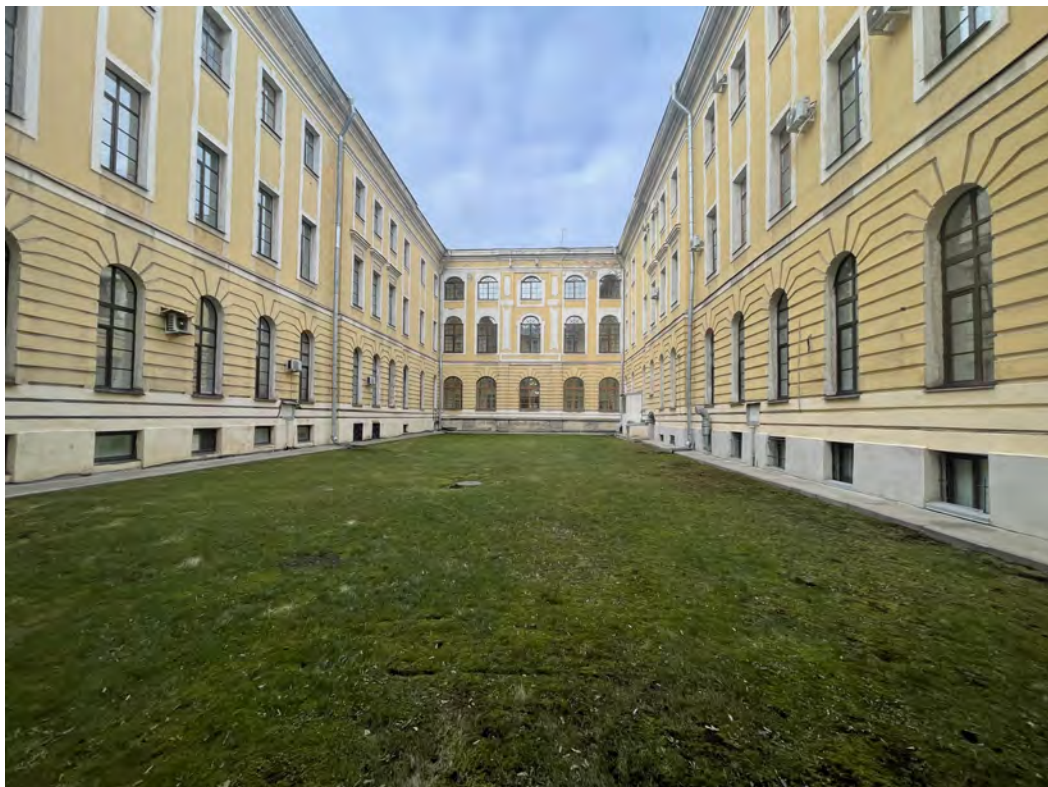
12. Вид на западный корпус и внутренний двор объекта культурного наследия федерального значения «Главное здание», расположенного по адресу: г. Санкт-Петербург, ул. Смольного, дом 3, литера А (Смоленого ул. 3), входящего в состав ансамбля «Институт Александровский» (Смольного ул.,3, Смольная наб.);
