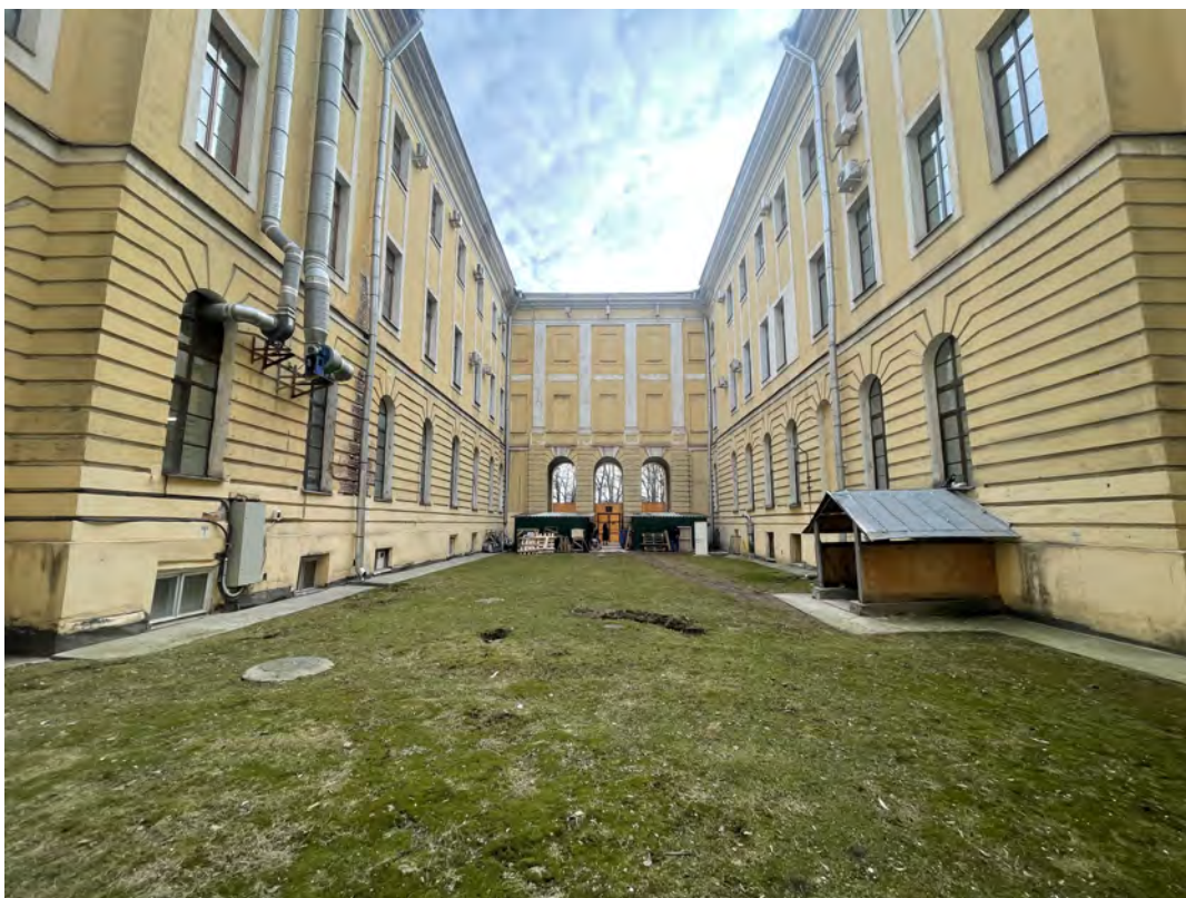
9. Вид на западный корпус и внутренний двор объекта культурного наследия федерального значения «Главное здание», расположенного по адресу: г. Санкт-Петербург, ул. Смольного, дом 3, литера А (Смоленого ул. 3), входящего в состав ансамбля «Институт Александровский» (Смольного ул.,3, Смольная наб.);
