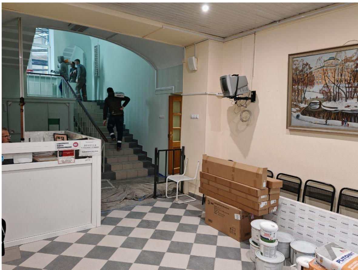
3. Вид на существующую входную группу и лестницу со стороны тамбура.
