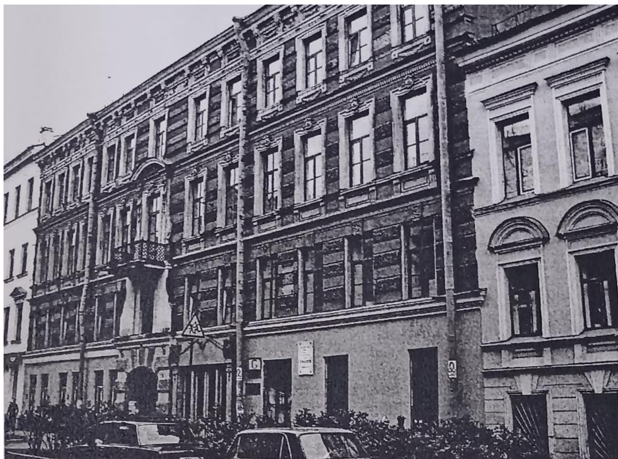
29. Лицевой фасад. Фото 2004 г. Архив КГИОП. Акт оценки технического состояния по внешним признакам дефектов и повреждений от 07 июня 2004 года. СПб., 2004. Раздел «Фотофиксация».
