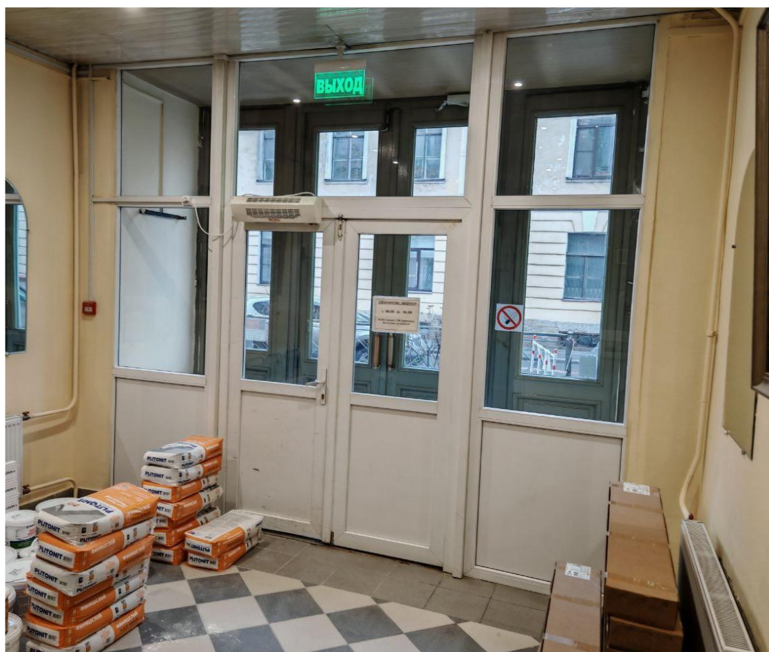
2. Вид на существующий тамбур.
