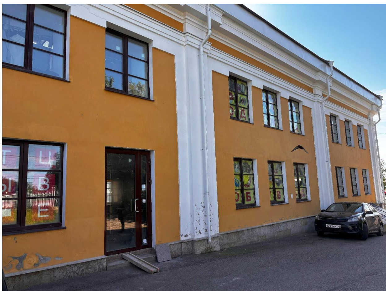
2. Северный фасад здания.
