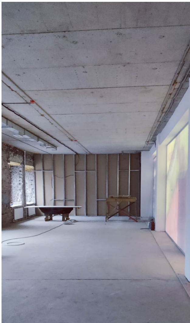
14. Помещения №3 и №4 в уровне 2-го этажа выявленного объекта культурного наследия «Жилой дом», расположенного по адресу: Санкт-Петербург, г. Ломоносов, Кронштадтская ул., д. 2, литера А.
