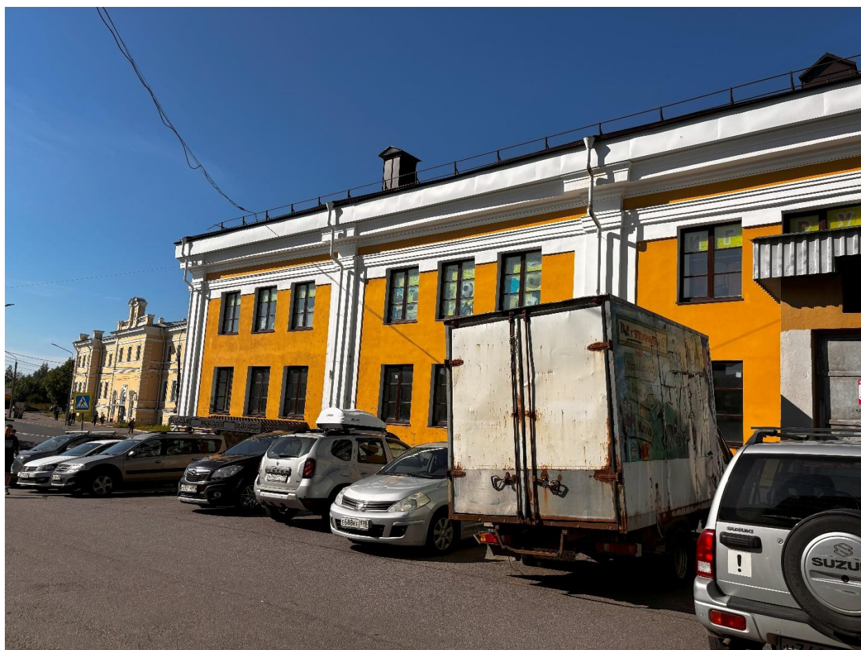
5. Фрагмент южного фасада здания.
