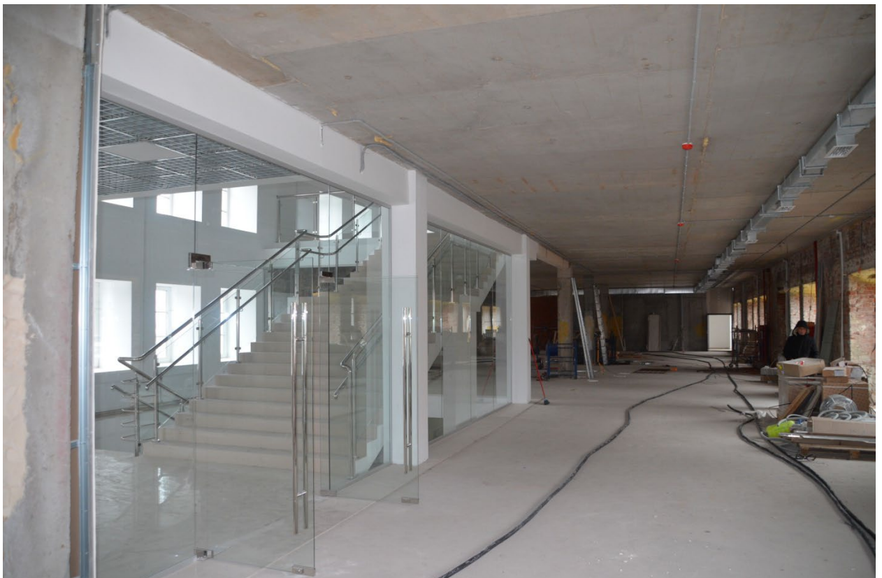
8. Общий вид 1-го этажа с главной лестницей выявленного объекта культурного наследия «Жилой дом», расположенного по адресу: Санкт-Петербург, г. Ломоносов, Кронштадтская ул., д. 2, литера А.
