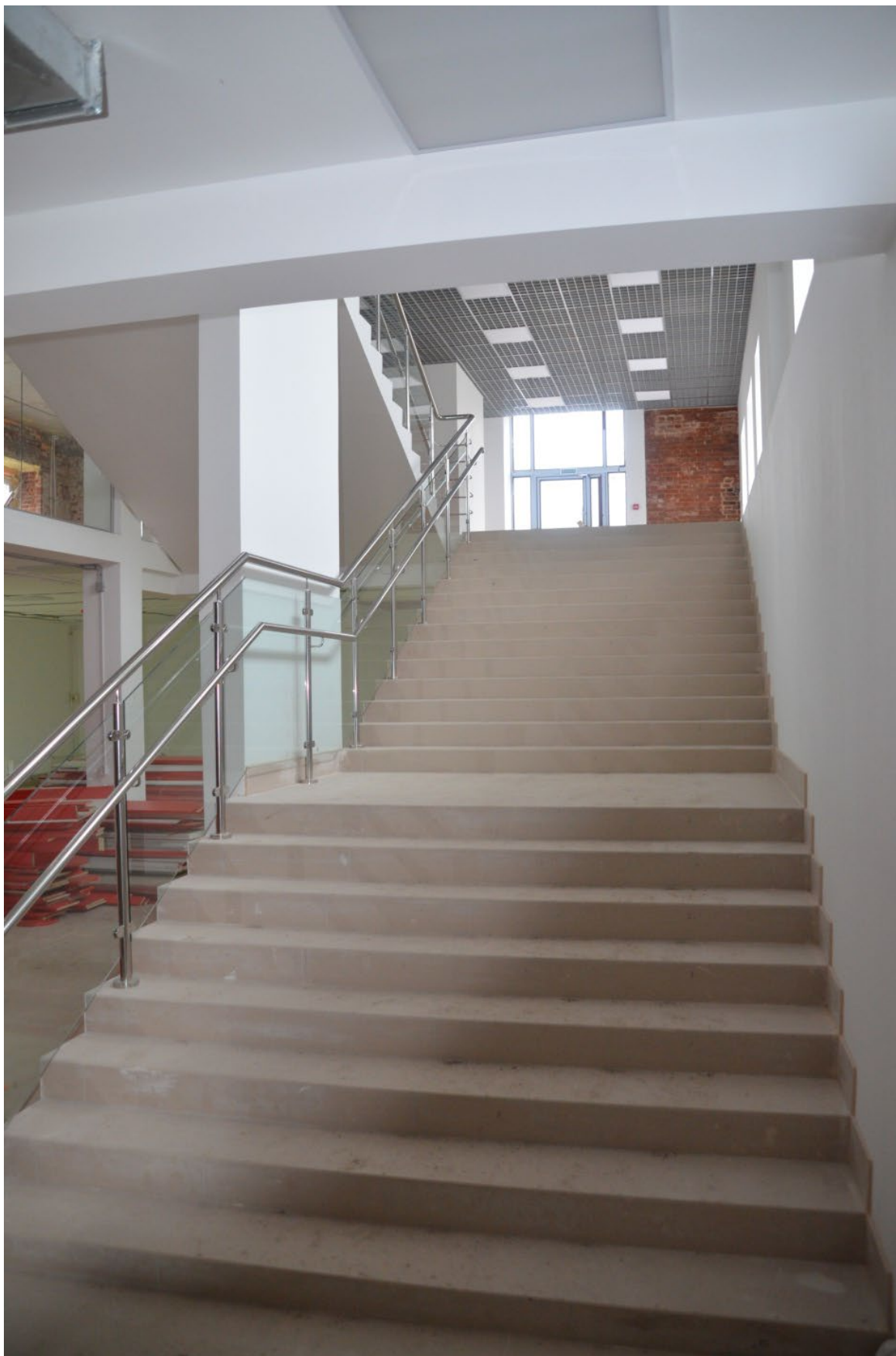
13. Вид главной лестницы между подвальным и 1-м этажами выявленного объекта культурного наследия «Жилой дом», расположенного по адресу: Санкт-Петербург, г. Ломоносов, Кронштадтская ул., д. 2, литера А.
