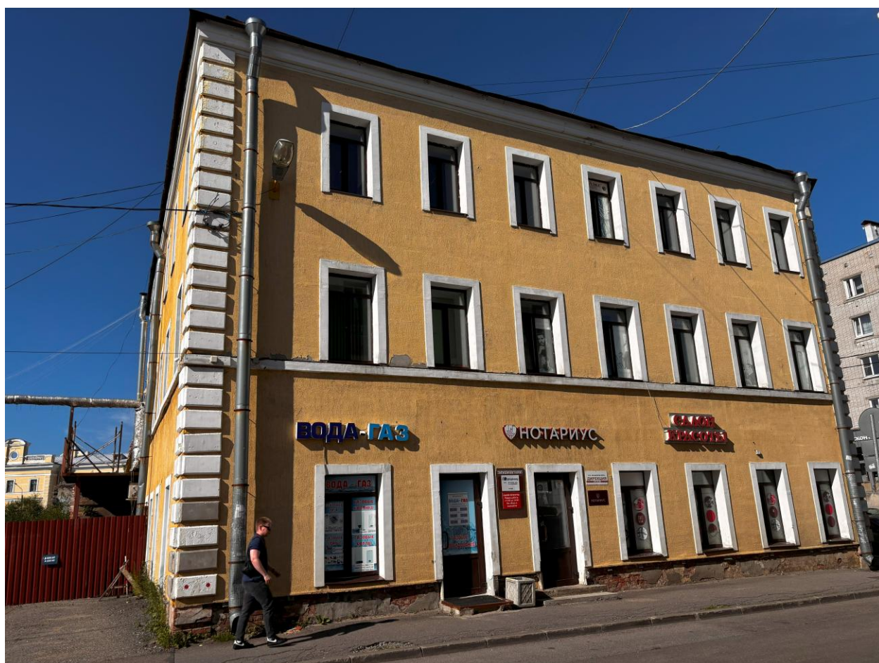
Фото 4. Южный фасад здания.
