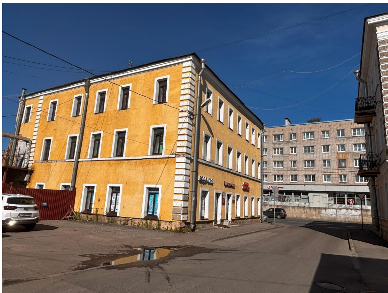
Фото 5. Общий вид с юго-запада.
