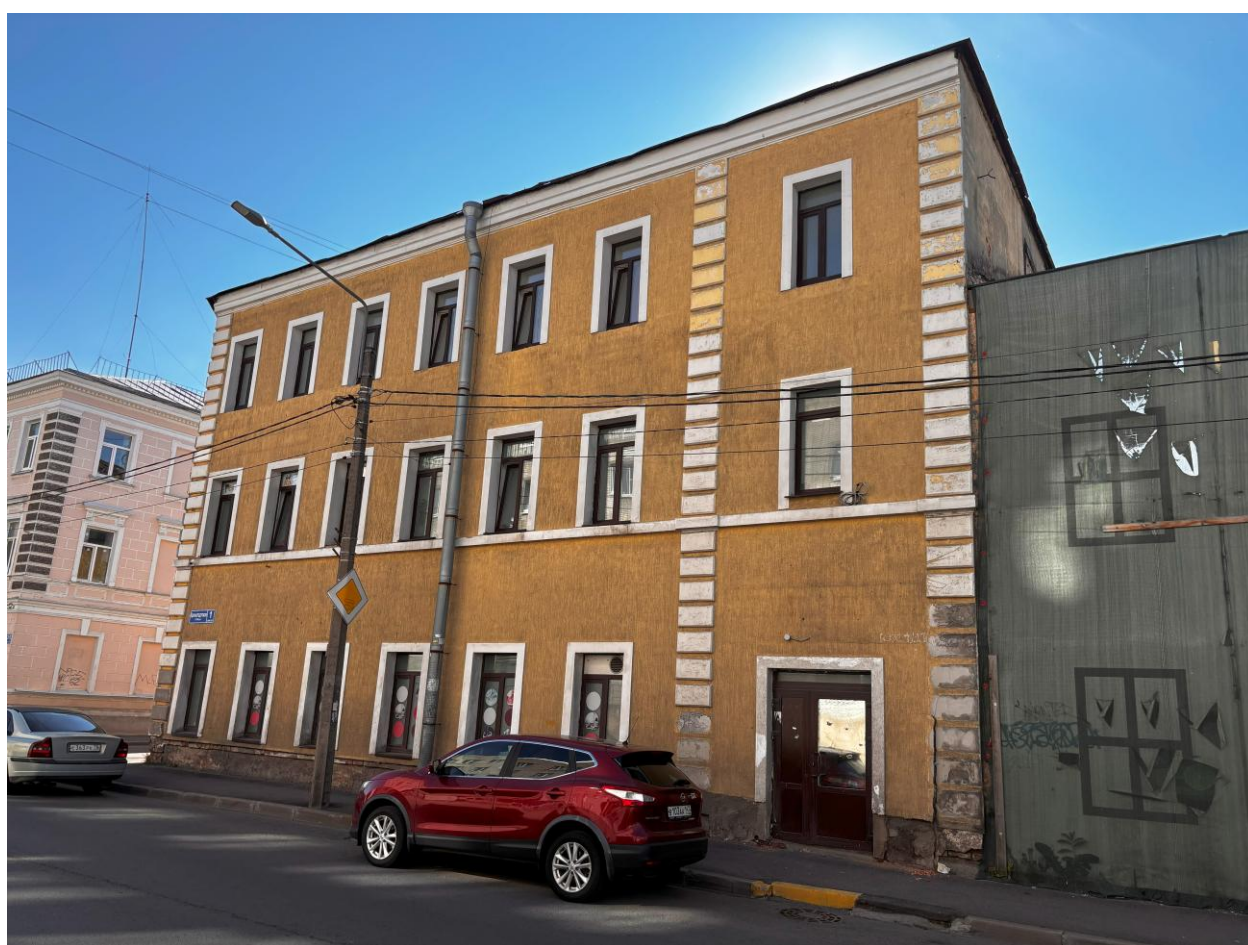
Фото 2. Восточный фасад здания.
