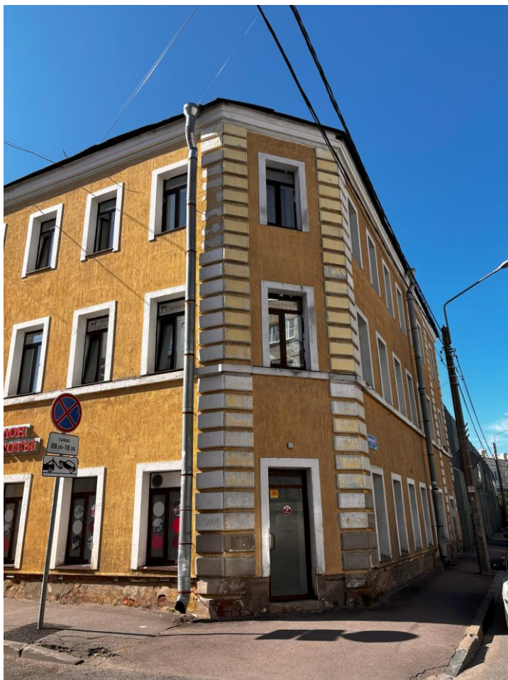
Фото 3. «Скошенный» угол здания.
