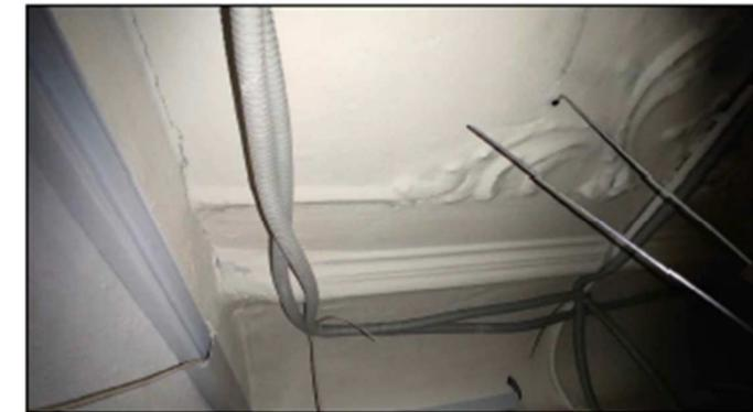
Фото 18 - помещение 23-Н (1) в осях В-Г/1/2-2б. Профилированная тяга и лепная композиция. Декоративное оформление потолка отсутствует на перегородке между пом 23-Н (1 и 5) (на фото слева)\*
