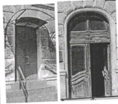
проемы балконных дверей - габариты, конфигурация (прямоугольной формы, с полуциркульным и лучковым завершением), местоположение, профилированные раскрепованные наличники, фигурные сандрики с лепными композициями, замковые камни; историческое заполнение проемов балконных дверей - конфигурация, исторический рисунок и материал (дерево);
