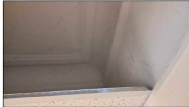
Фото 23 - помещение 23-Н (1) в осях Г1-Д/2-26. Профилированная тяга и падуга по периметру капитальных стен.
