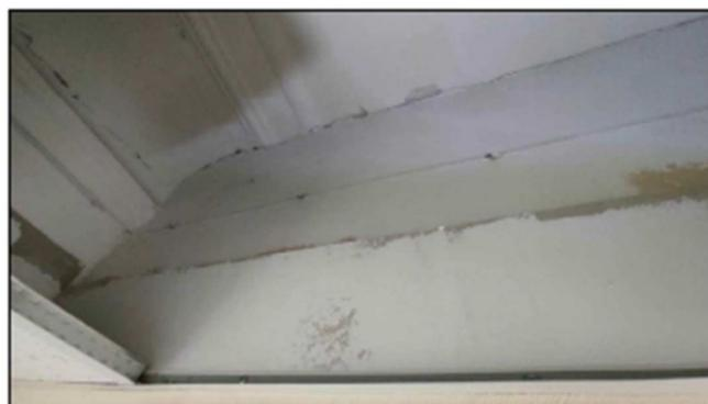
Фото 5 - помещение 23-Н (2). Профилированные тяга и падуга на перегородке между пом. 23-Н (2 и 1). На перегородке между пом. 23-Н (2 и 3) декоративное оформление отсутствует\*
