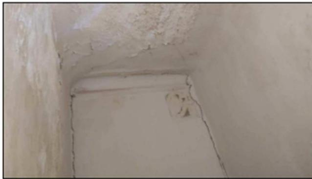
Фото 28 - помещение 23-Н (12). Профилированные тяга и падуга вдоль капитальной стены (по оси Д). Декоративное оформление потолка отсутствует по периметру перегородок
