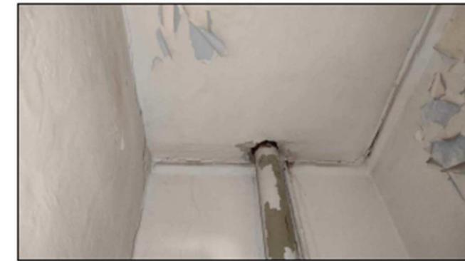
Фото 30 - помещение 23-Н (11). Профилированная тяга вдоль по периметру капитальных стен (по оси Д и 3а). Декоративное оформление потолка отсутствует по периметру перегородок
