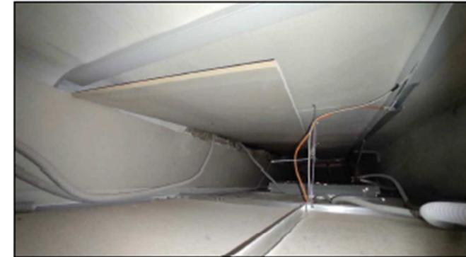
Фото 24 - помещение 23-Н (1) в осях Г1-Г2/2-3а. Декоративное оформление потолка отсутствует
