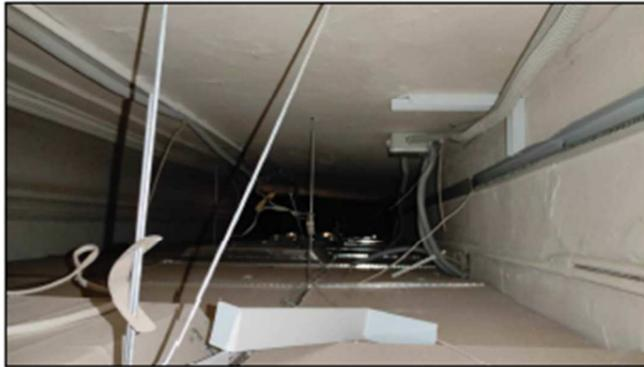
Фото 19 - помещение 23-Н (1) в осях В-Г1/2-26. Профилированная тяга и падуга вдоль капитальной стены в осях 2/В-Г1. Декоративное оформление потолка отсутствует на перегородке между пом 23-Н (1 и 5)\*
