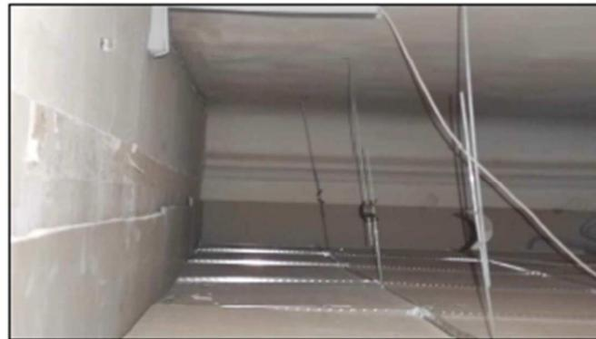
Фото 17 - помещение 23-Н (5). Профилированные тяга и падуга по периметру капитальных стен. Декоративное оформление потолка по периметру перегородок отсутствует\*
