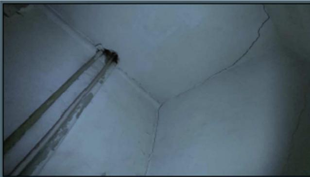
Фото 31 - помещение 23-Н (11). Профилированная тяга вдоль по периметру капитальных стен (по оси Д и 3а). Декоративное оформление потолка отсутствует по периметру перегородок
