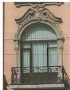
оконные проемы - габариты, конфигурация (прямоугольной формы, с полуциркульным и лучковым завершением, круглое окно центрального аттикового объема), местоположение, профилированные раскрепованные наличники, замковые камни, лучковые и фигурные сандрики с лепными композициями, профилированные подоконные выступы, с волютами, лилиями, сухариками; историческое заполнение оконных проемов - конфигурация, исторический рисунок и материал (дерево);
