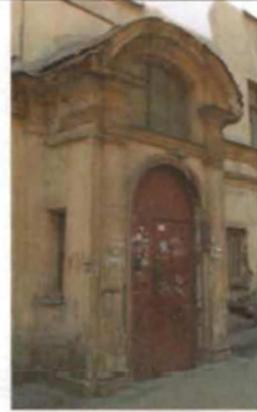
пять проемов ворот (конюшен) - габариты, конфигурация (прямоугольной формы с лучковым завершением), местоположение; историческое заполнение проемов ворот - конфигурация, исторический рисунок и материал (дерево);
