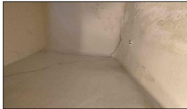
Фото 29 - помещение 23-Н (12). Декоративное оформление потолка отсутствует по периметру перегородок
