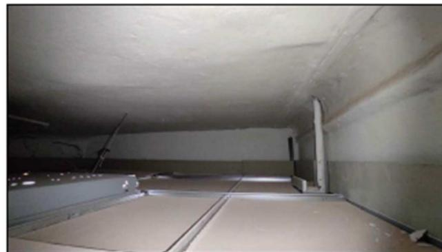
Фото 26 - помещение 23-Н (10). Профилированные тяга и падуга вдоль капитальной стены (по оси Д). Декоративное оформление потолка отсутствует по периметру перегородок
