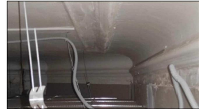
Фото 15 - помещение 23-Н (5). Профилированные тяга и падуга по периметру капитальных стен
