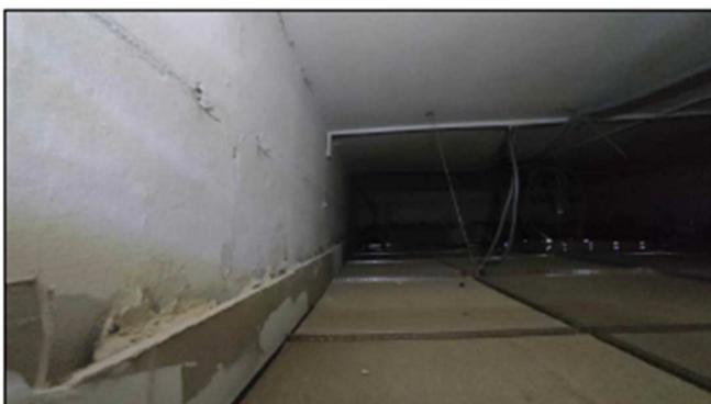
Фото 4 - помещение 23-Н (2). Декоративное оформление потолка отсутствует на перегородке между пом. 23-Н (2 и 3)\*
