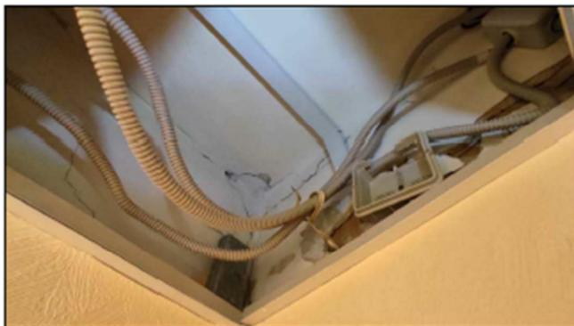
Фото 25 - помещение 23-Н (1) в осях Г1-Г2/2-3а. Декоративное оформление потолка отсутствует
