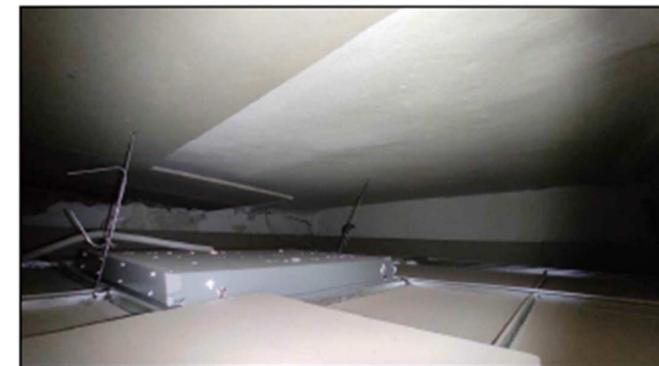
Фото 27 - помещение 23-Н (10). Декоративное оформление потолка отсутствует по периметру перегородок
