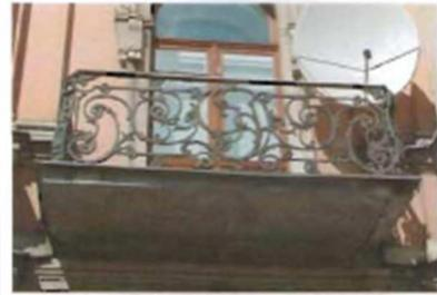
кованный козырек над входом центрального входа, два кронштейна – материал (металл), техника исполнения (ковка), рисунок (вольтообразный орнамент с розетками);
