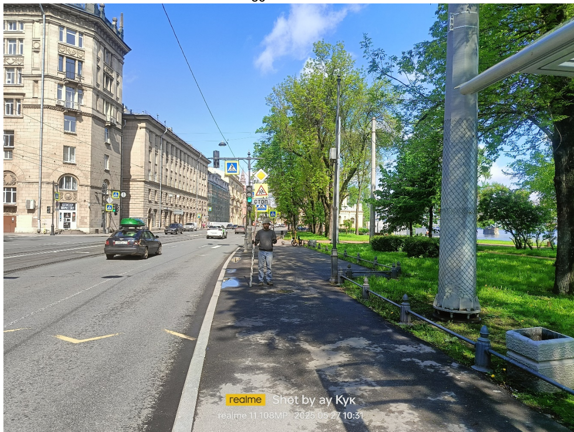
Рис. 13. Обуховской Обороны пр.-2025, ТКК №23. Точка фотофиксации 1, вид с юго-востока.
