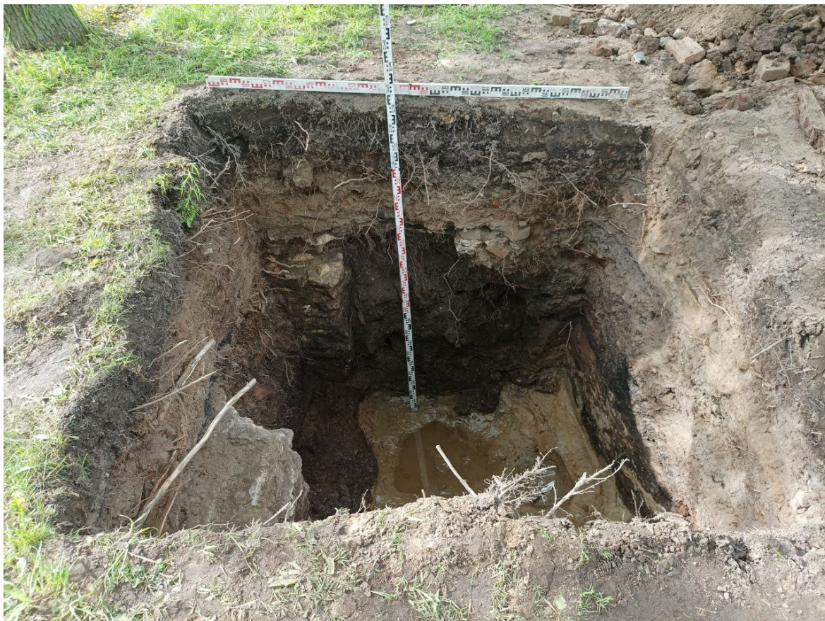
Рис. 29. Обуховской Обороны пр.-2025, ТКК №23. Шурф 2, фиксация по уровню окончания работ, вид с юго-востока.
