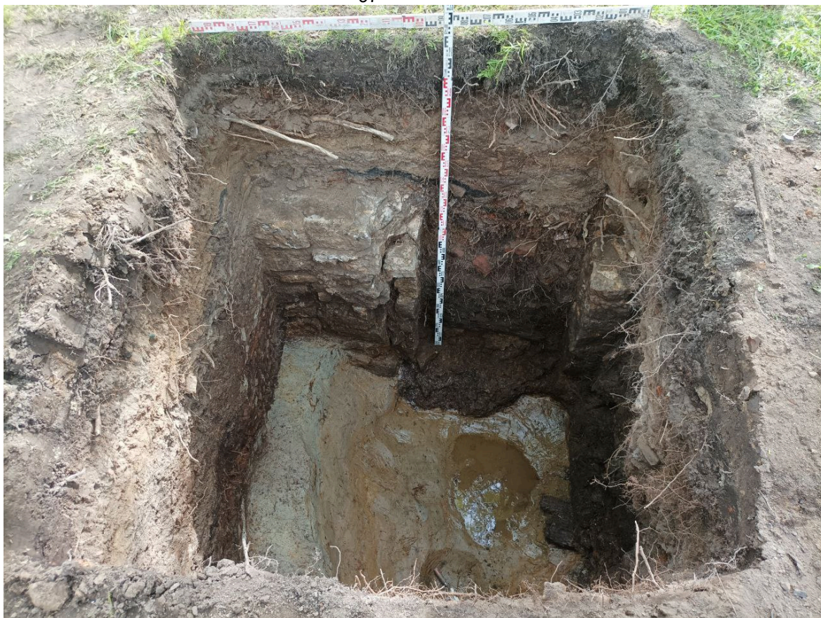
Рис. 35. Обуховской Обороны пр.-2025, ТКК №23. Шурф 2, фиксация по уровню окончания работ, вид с северо-востока.
