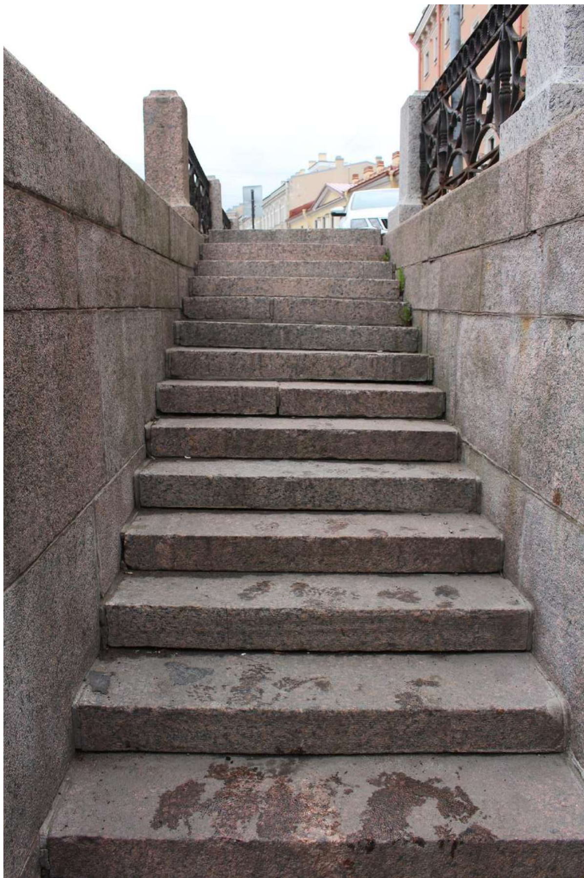
Фото 6. Вид на лестницу спуска № 15 объекта культурного наследия федерального значения «Набережные со спусками» на уч. наб. р. Мойки «Синий мост – Фонарный мост», литера Б.
