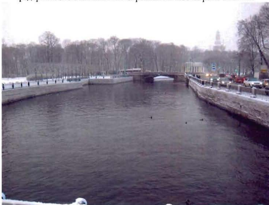
1. Набережные. Вид со стороны Инженерного Первого моста
