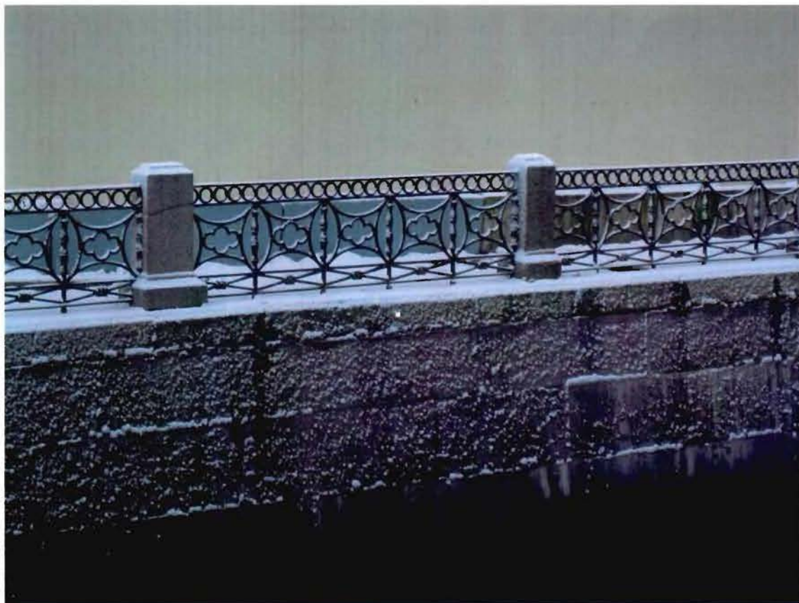
6. Ограждение набережной. Левобережная стенка
