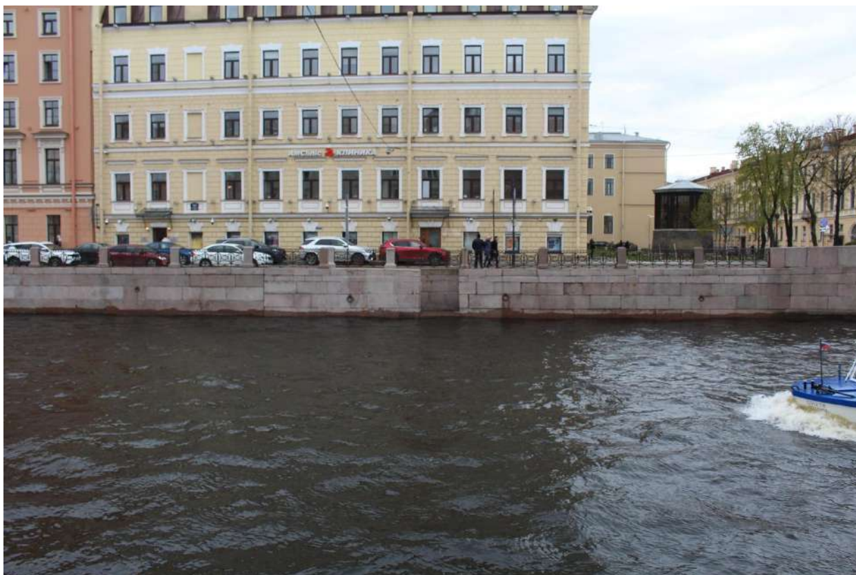
Фото 7. Вид на спуск № 15 объекта культурного наследия федерального значения «Набережные со спусками» на уч. наб. р. Мойки «Синий мост – Фонарный мост», литера Б с севера.
