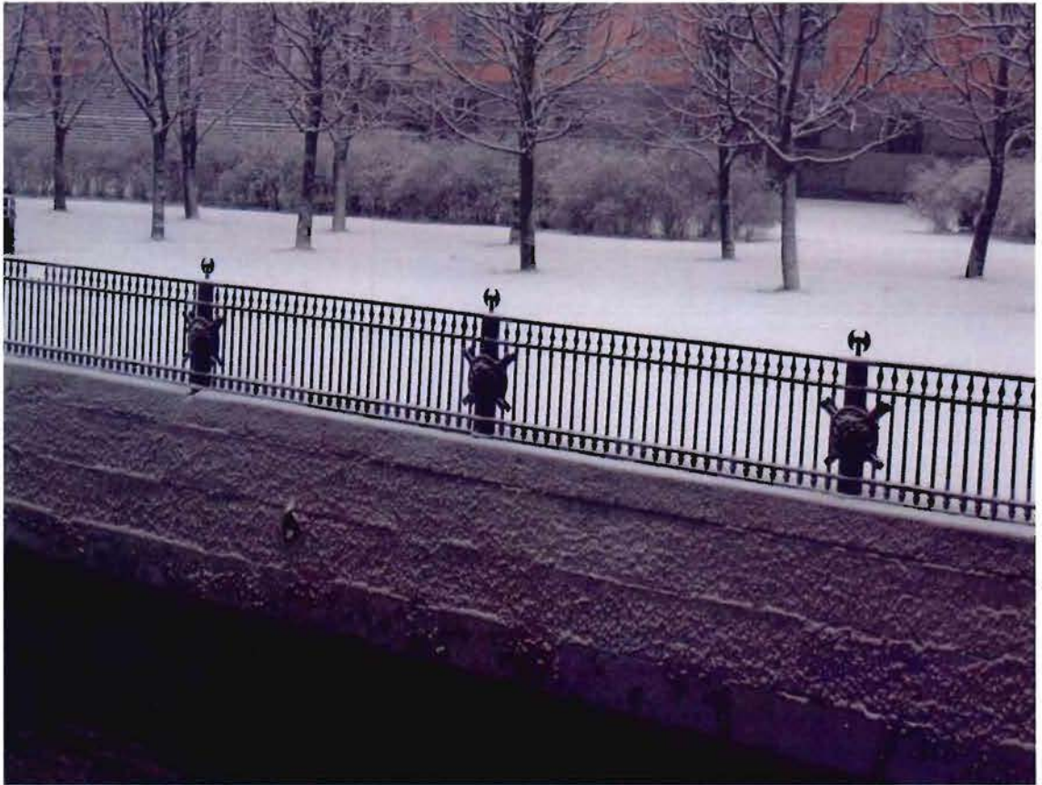
3. Ограждение набережной со стороны Михайловского (Инженерного) замка
