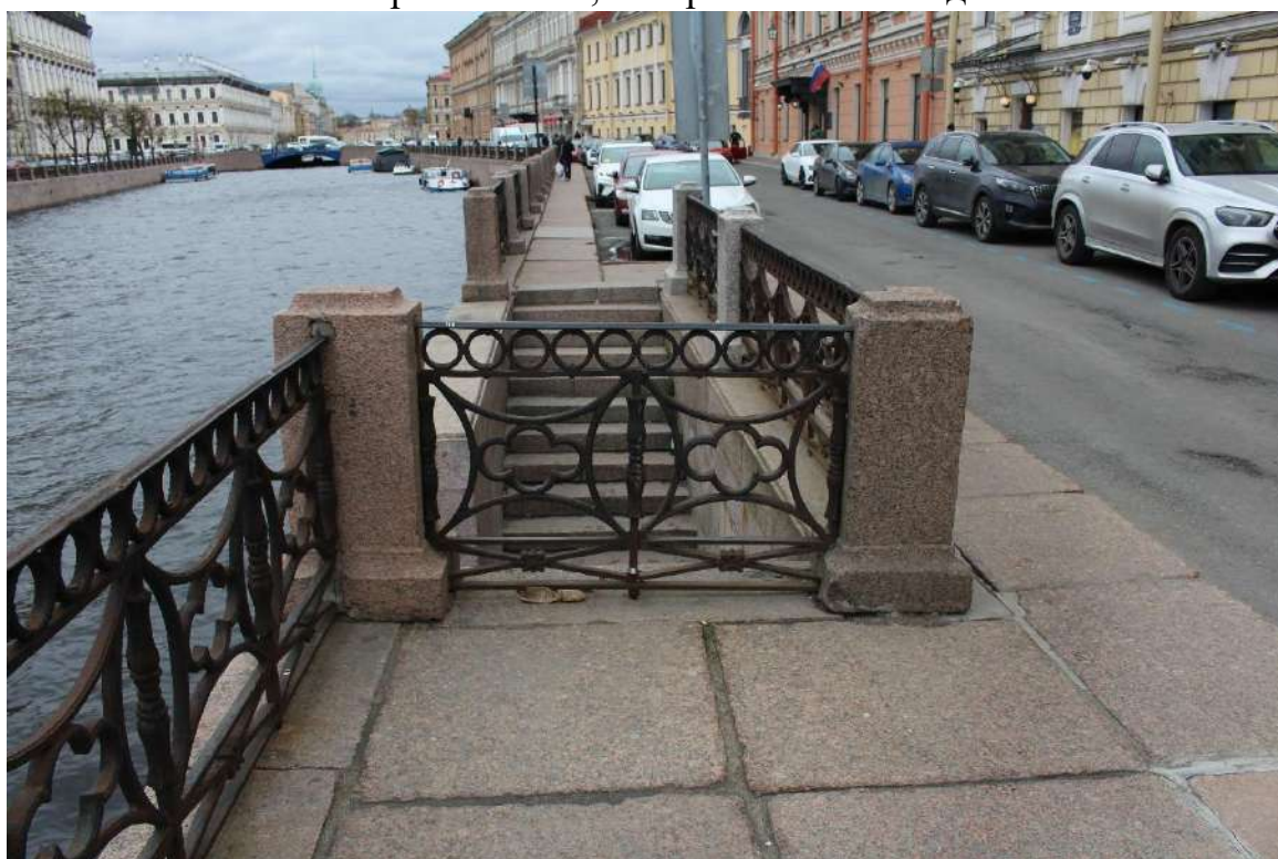
Фото 2. Вид на спуск № 15 объекта культурного наследия федерального значения «Набережные со спусками» на уч. наб. р. Мойки «Синий мост – Фонарный мост», литера Б с запада.
