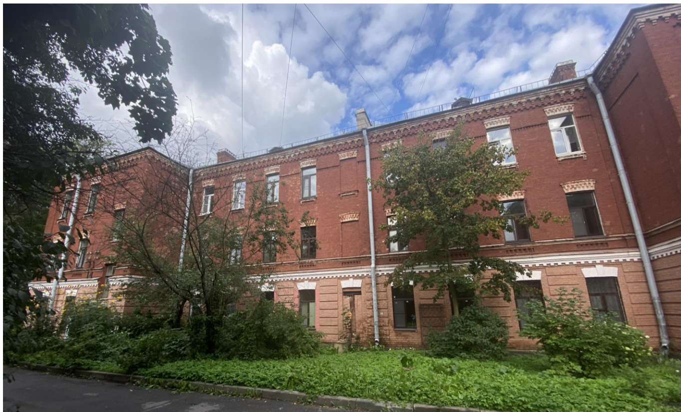
Фот. 10. Вид на ОКН «Здание казармы» по адресу: г. Пушкин, ул. Радищева, д. 25/14, входящий в состав ансамбля «Офицерская артиллерийская школа», дворовый фасад
