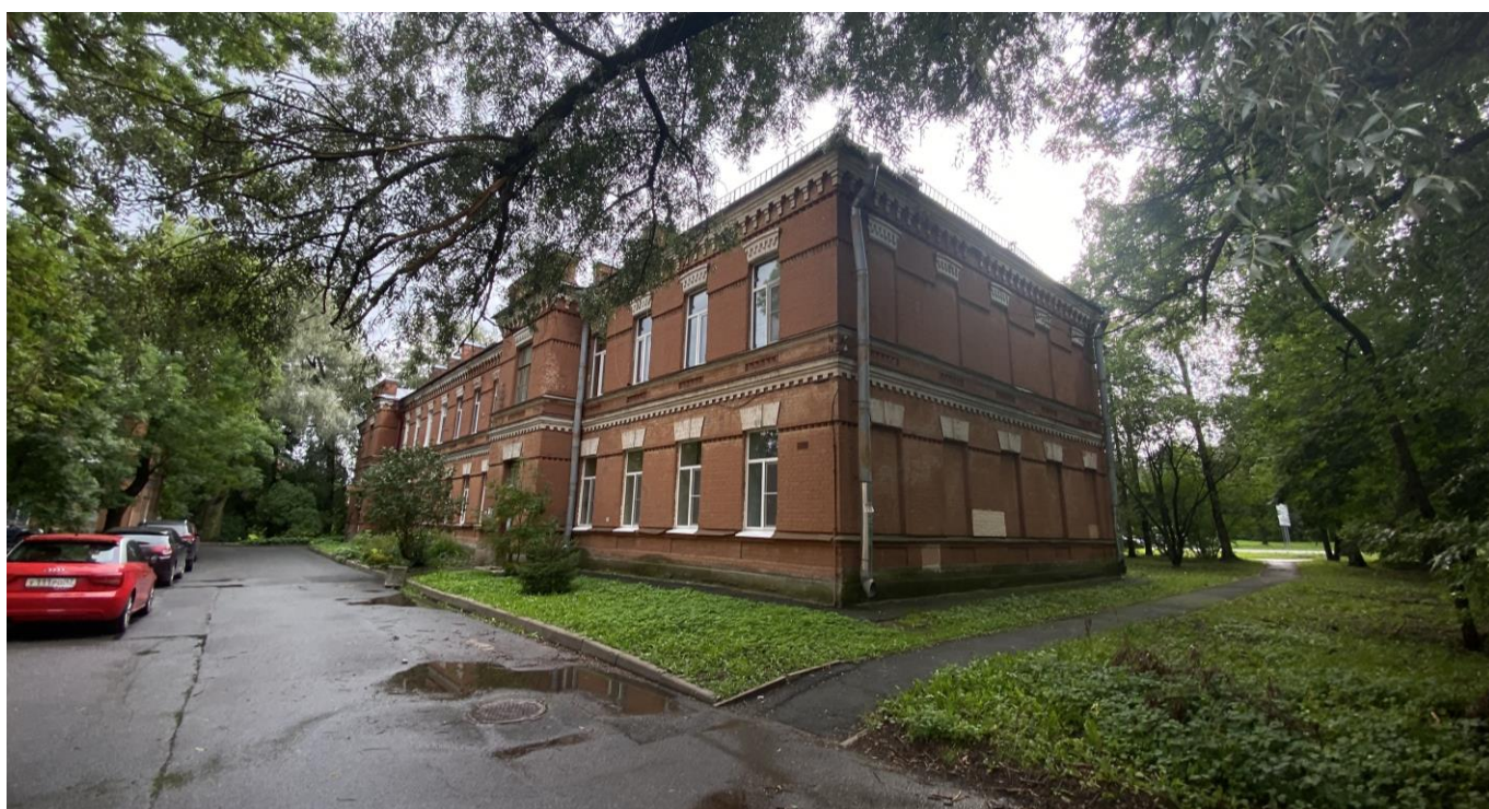
Фот. 5 Вид на ОКН «Здание казармы» по адресу: г. Пушкин, ул. Кадетский бульвар, д. 32/20, входящий в состав ансамбля «Офицерская артиллерийская школа», дворовый фасад, вид на территорию выявленного объекта культурного наследия
