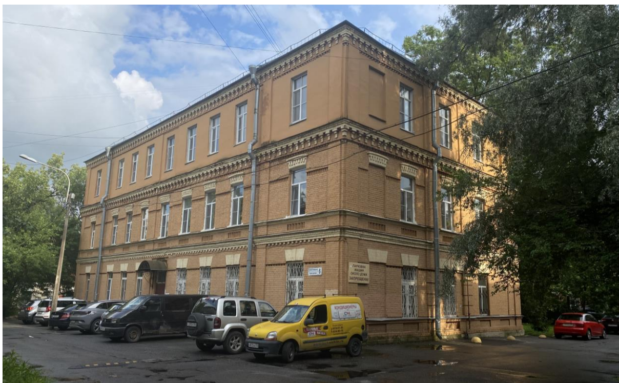
Фот. 7. Вид на ОКН «Здание казармы» по адресу: г. Пушкин, пер. Прямой, д. 6, входящий в состав ансамбля «Офицерская артиллерийская школа», фасад, ориентированный на Прямой пер.
