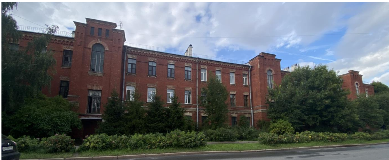
Фот. 2 Вид на ОКН «Здание казармы» по адресу: г. Пушкин, ул. Саперная, д. 16, входящий в состав ансамбля «Офицерская артиллерийская школа», главный фасад на ул. Саперная
