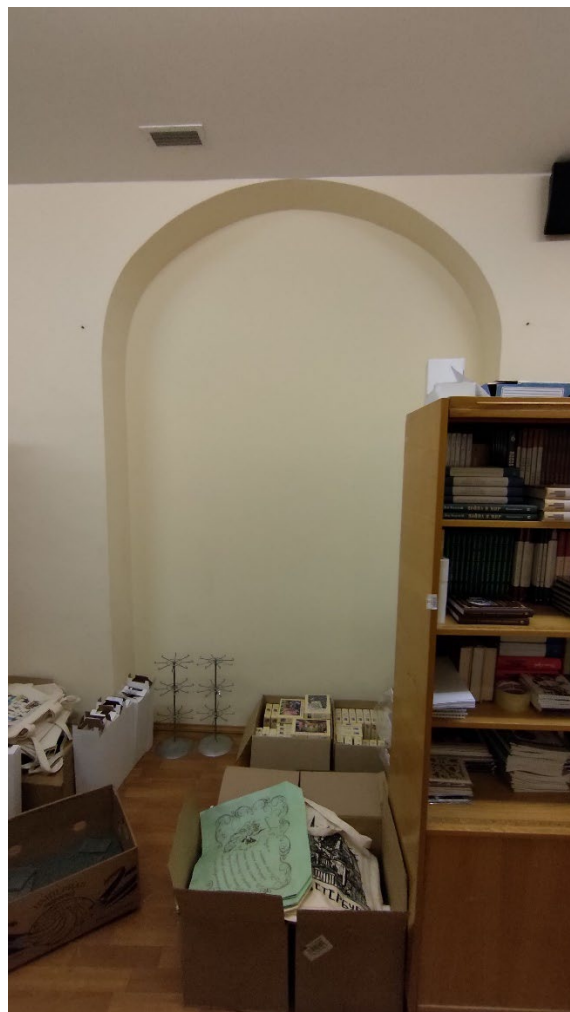
Фото 14. Заложенный арочный проём в помещении 1, 15-Н. Опорные пилоны. Общий вид. Дата фотофиксации: 27.05.25.
