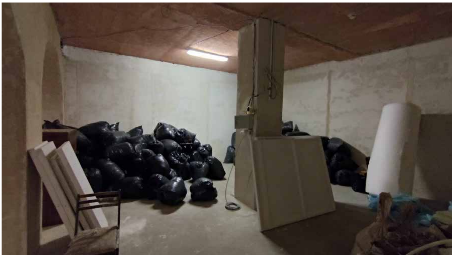
Фото 26. Объём помещений 1-2, 13-Н. Опорные пилоны. Фрагмент. Дата фотофиксации: 27.05.25.
