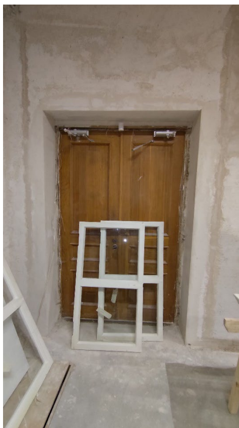
Фото 32. Современное деревянное заполнение в помещении 1, 13-Н. Общий вид. Дата фотофиксации: 27.05.25.
