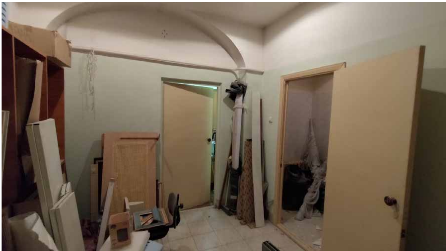
Фото 17. Заложенные арочные проёмы. Опорные пилоны. Помещение 2, 14-Н. Общий вид. Дата фотофиксации: 27.05.25.
