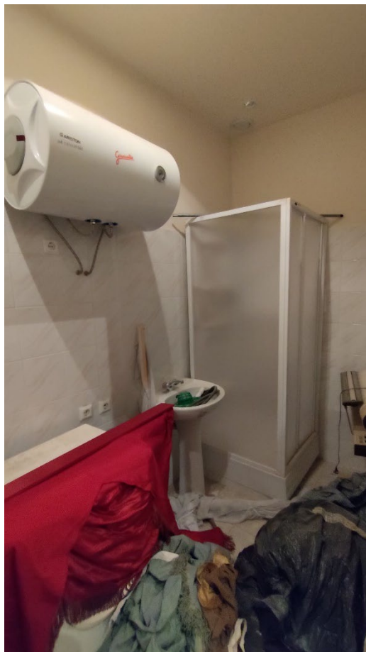
Фото 19. Помещение 3, 14-Н. Общий вид. Дата фотофиксации: 27.05.25.
