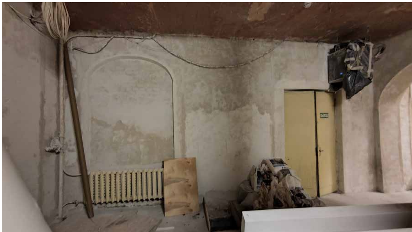
Фото 24. Заложенный проём каретника. Объёмы помещений 3-5, 13-Н. Общий вид. Дата фотофиксации: 27.05.25.
