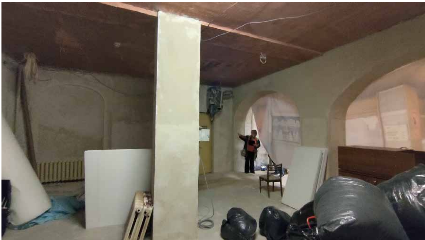
Фото 27. Объём помещений 1-2, 13-Н. Опорные пилоны под арочными проёмами. Фрагмент. Дата фотофиксации: 27.05.25.
