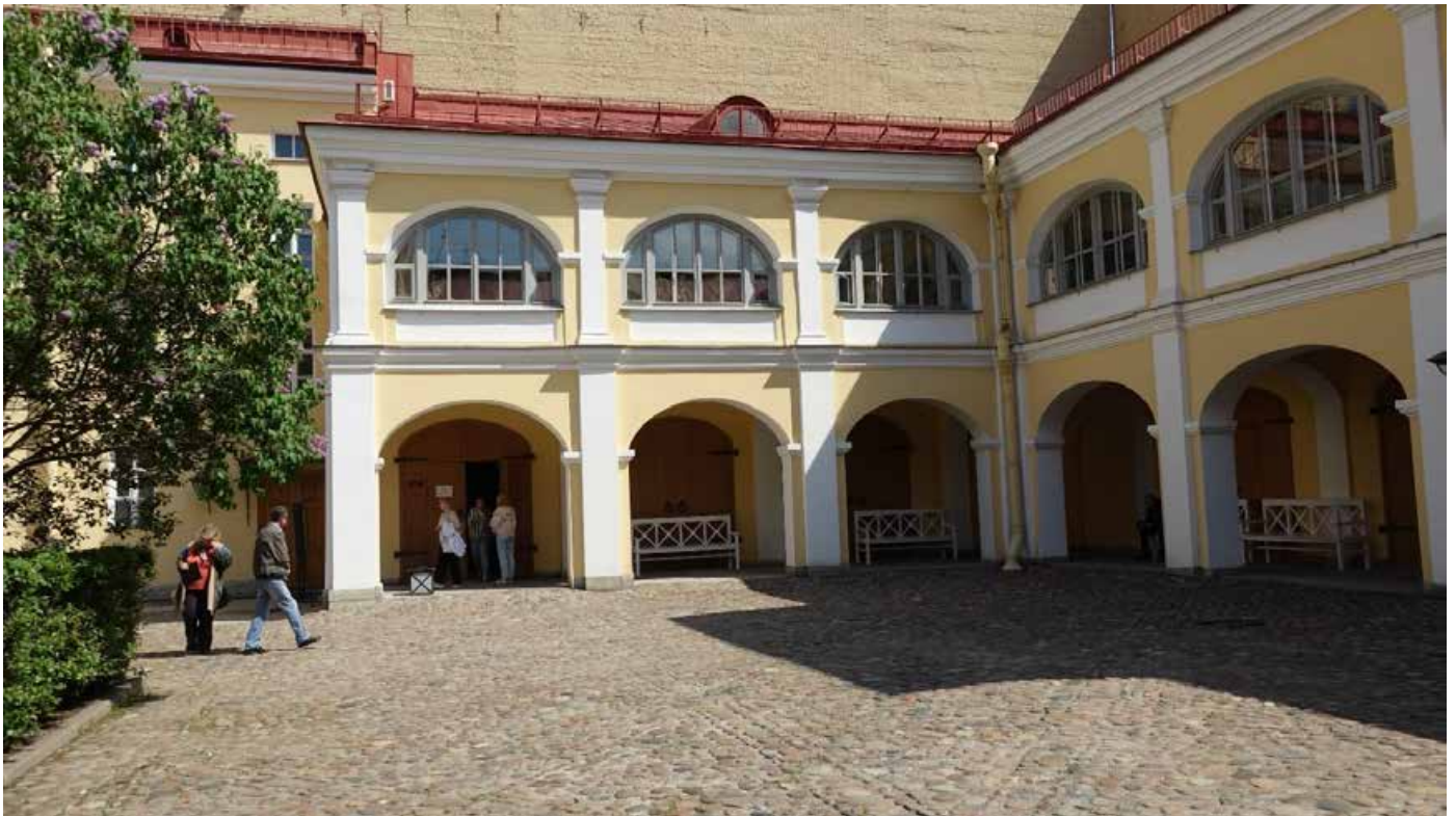
Фото 3. Галереи вдоль восточного фасада дворового фасада. Арочные перекрытия с коробовым завершением. Фрагмент. Дата фотофиксации: 27.05.25.
