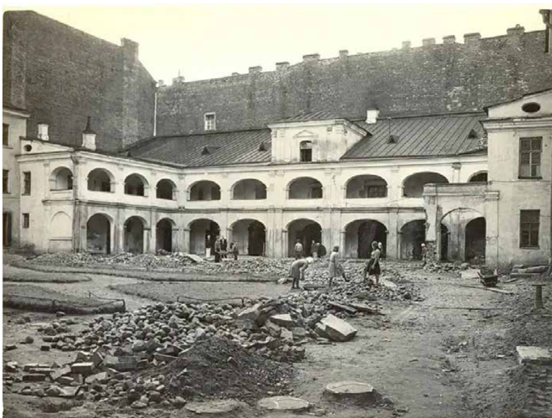
Илл. №12. Строительные работы во дворе дома на Мойке, 12. Партерные клумбы. 1947 г. ( https://pastvu.com/ )
