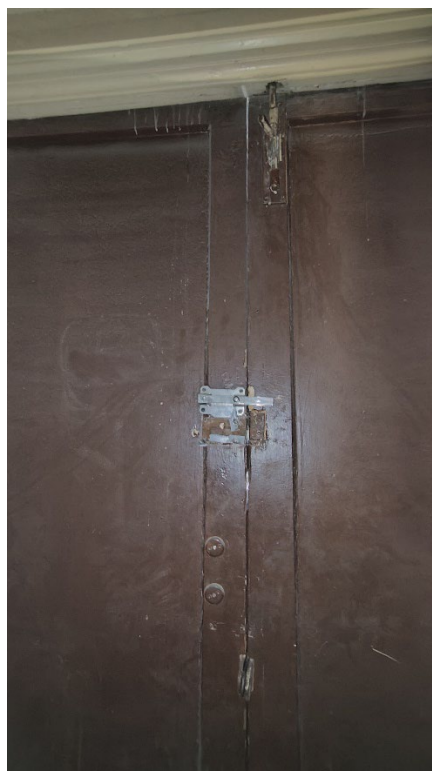
Фото 30. Современные дверные заполнения каретников. Фрагмент. Дата фотофиксации: 27.05.25.
