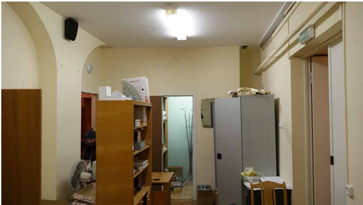
Фото 15. Опорные пилоны в помещении 1, 15-Н. Фрагмент. Дата фотофиксации: 27.05.25.
