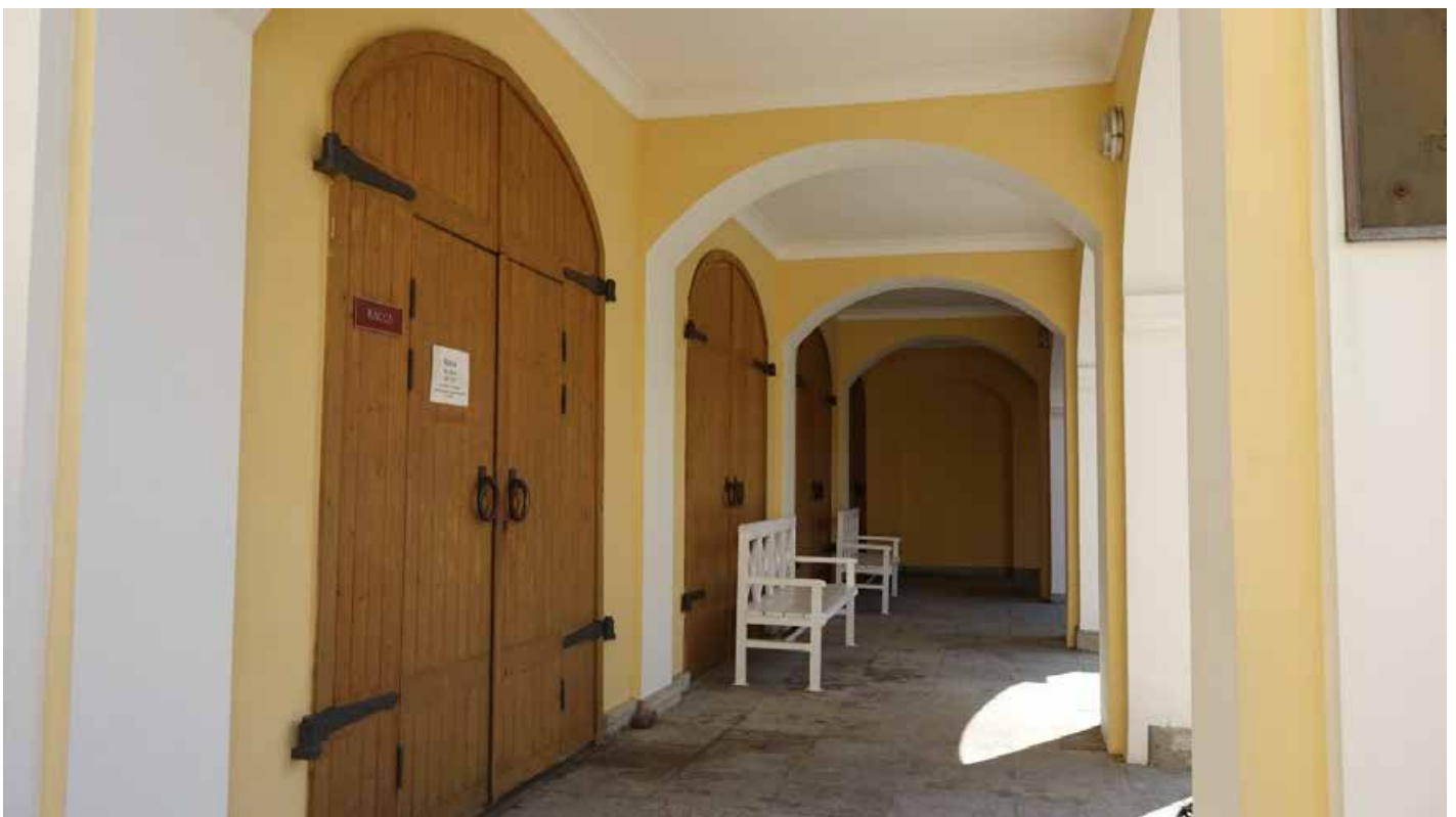
Фото 4. Арочные перекрытия. Фрагмент. Дата фотофиксации: 27.05.25.
