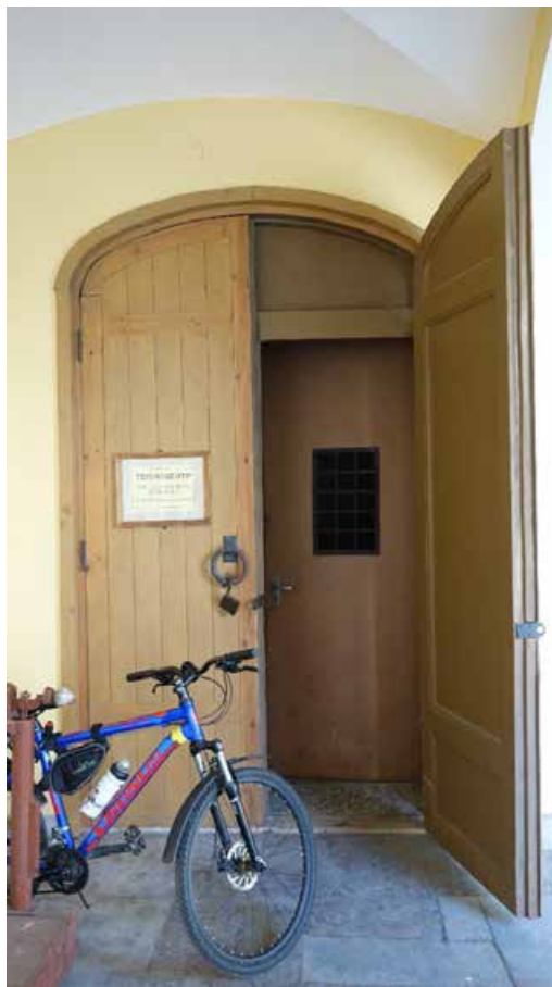
Фото 7. Исторический проём каретника. Современное деревянное заполнение. Общий вид. Дата фотофиксации: 27.05.25.
