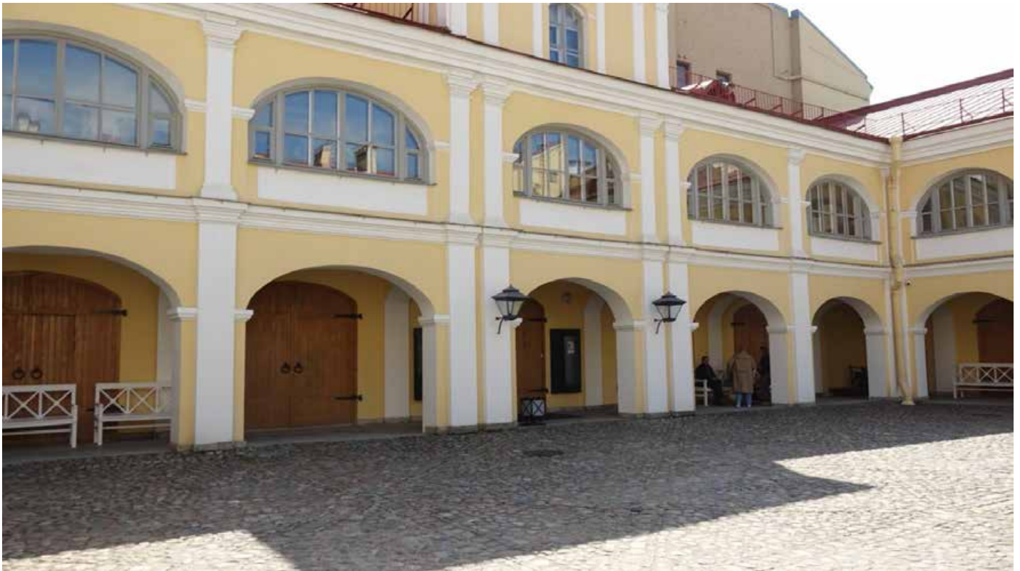
Фото 1. Галереи вдоль южного дворового фасада. Арочные перекрытия с коробовым завершением. Фрагмент. Дата фотофиксации: 27.05.25.
