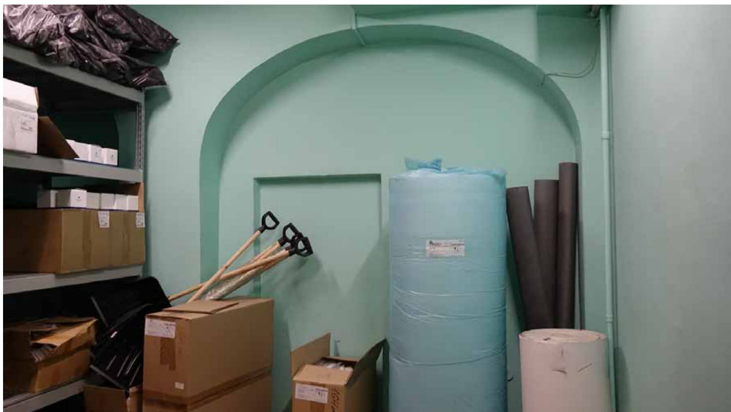
Фото 10. Заложенный арочный проём в помещении 4, 14-Н. Опорные пилоны. Общий вид. Дата фотофиксации: 27.05.25.
