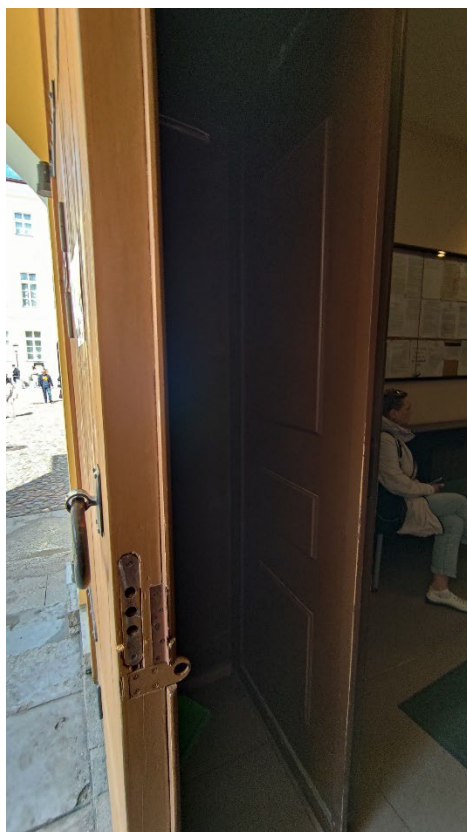
Фото 36. Тамбур в проёме каретника. Фрагмент. Дата фотофиксации: 27.05.25.
