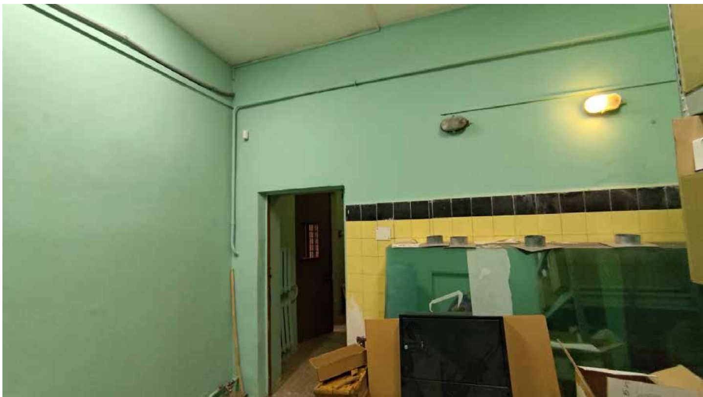
Фото 12. Помещение 14, 14-Н. Общий вид. Дата фотофиксации: 27.05.25.
