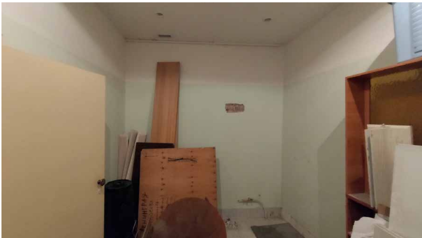
Фото 18. Помещение 2, 14-Н. Общий вид. Дата фотофиксации: 27.05.25.
