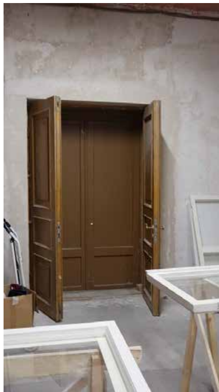
Фото 29. Современные деревянные заполнения каретников. Общий вид со стороны интерьера. Дата фотофиксации: 27.05.25.
