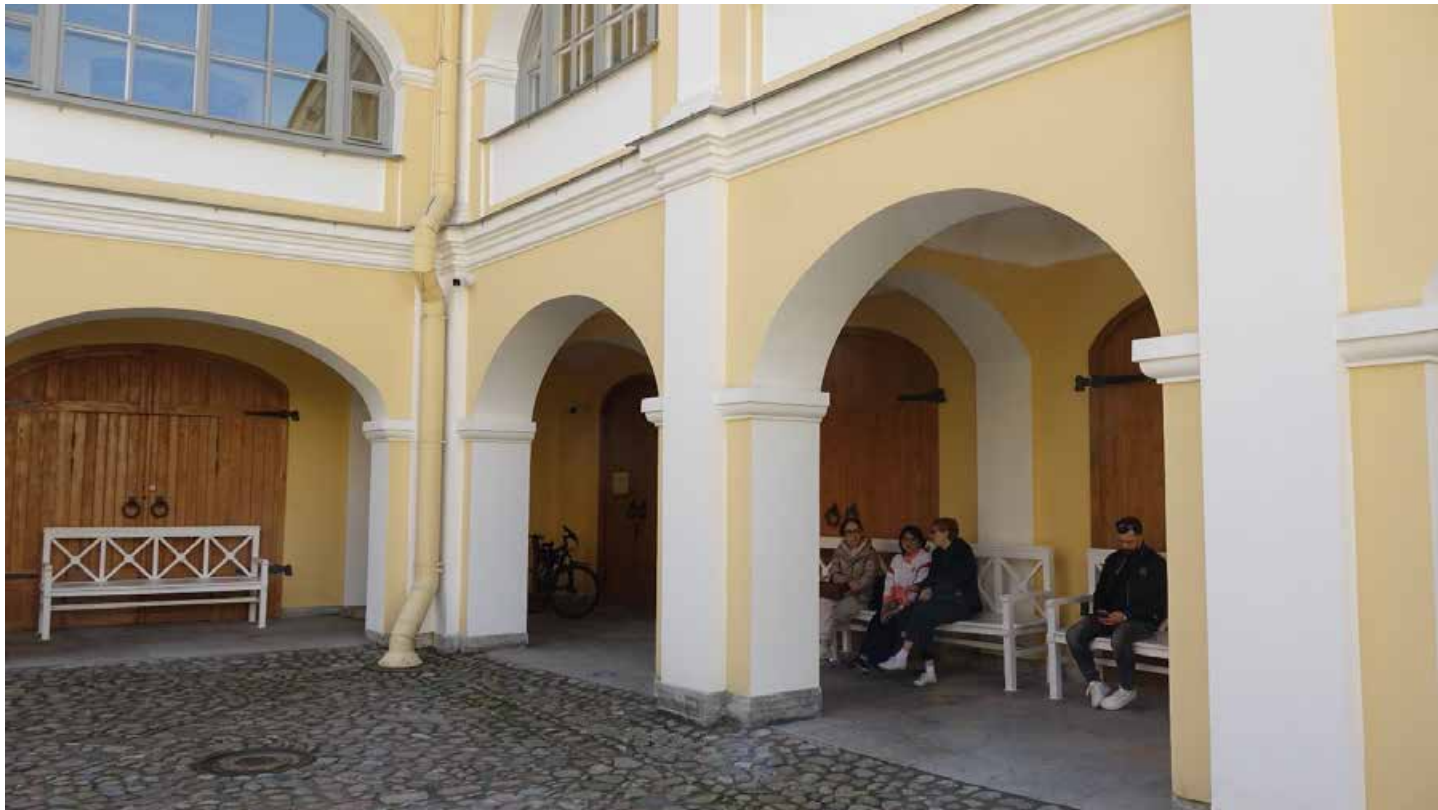
Фото 5. Арочные перекрытия западного фасада. Фрагмент. Помещение 14. Общий вид. Дата фотофиксации: 27.05.25.
