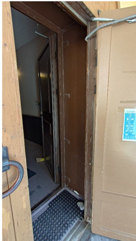
Фото 35. Тамбур в проёме каретника. Фрагмент. Дата фотофиксации: 27.05.25.
