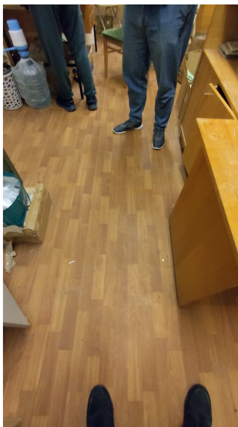
Фото 22. Современное покрытие пола в помещении 1, 15-Н. Фрагмент. Дата фотофиксации: 27.05.25.
