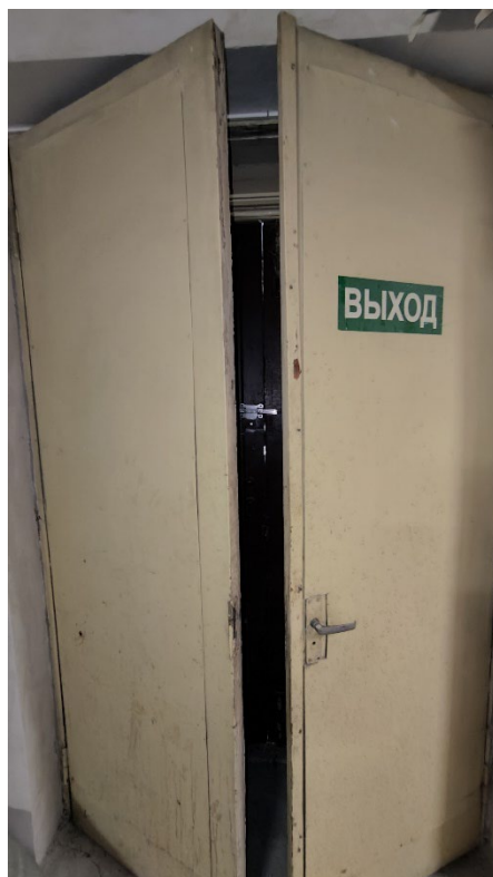
Фото 31. Современное деревянное заполнение в помещении 1, 13-Н. Общий вид. Дата фотофиксации: 27.05.25.
