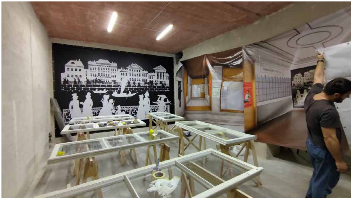
Фото 23. Помещение 1, 13-Н. Общий вид. Дата фотофиксации: 27.05.25.
