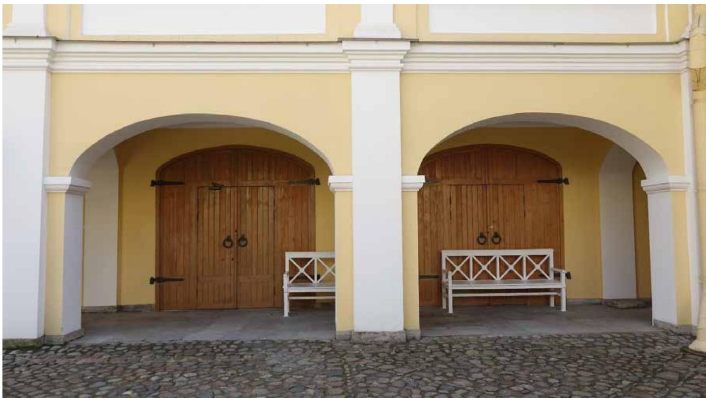
Фото 6. Исторические проёмы каретников. Современное деревянное заполнение. Общий вид. Дата фотофиксации: 27.05.25.
