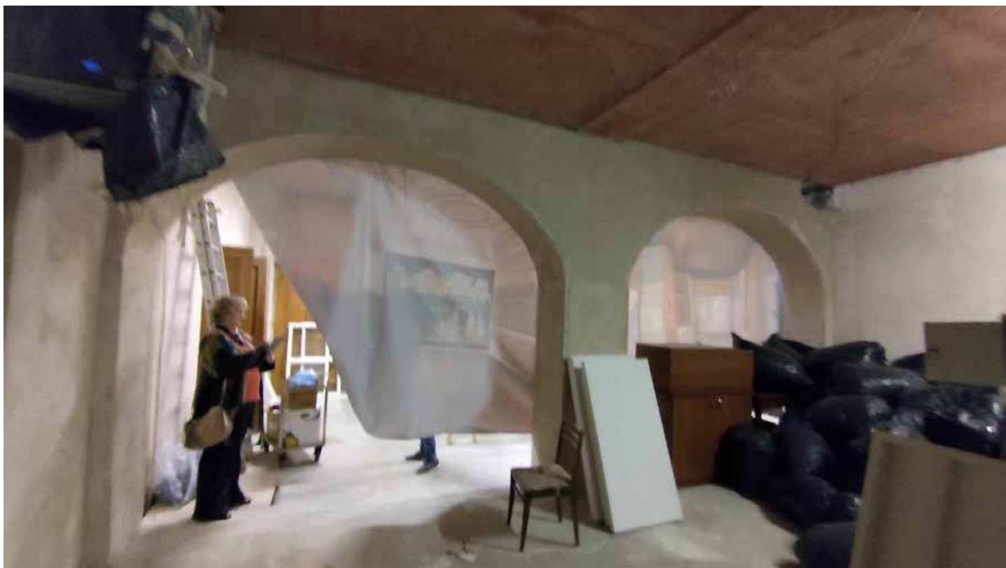
Фото 28. Арочные проёмы с опорными пилонами в объёмах помещений 1-2, 13-Н. Общий вид. Дата фотофиксации: 27.05.25.
