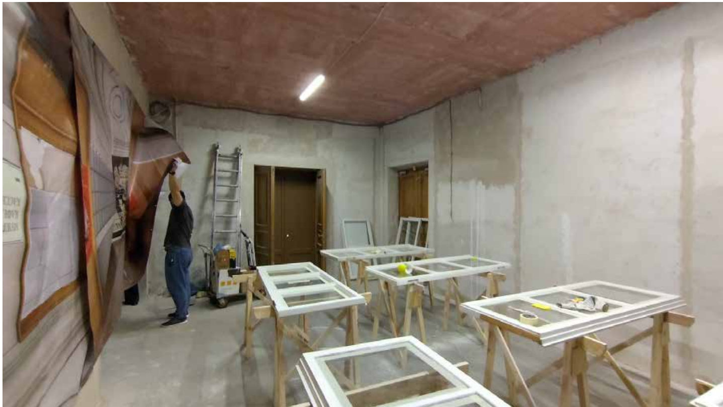
Фото 25. Помещение 1, 13-Н. Общий вид. Дата фотофиксации: 27.05.25.
