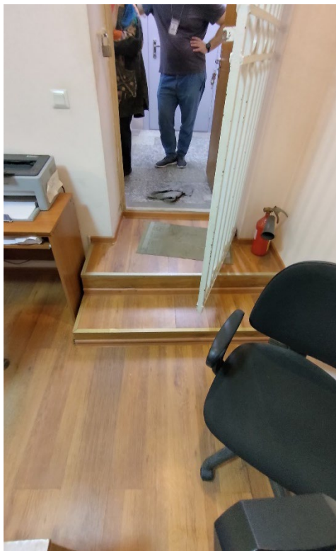
Фото 39. Лестница в помещении 1, 10-Н. Общий вид. Дата фотофиксации: 27.05.25.
