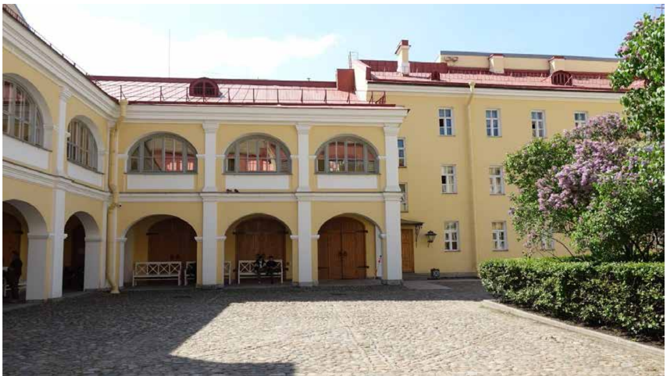
Фото 2. Галереи вдоль западного дворового фасада. Арочные перекрытия с коробовым завершением. Фрагмент. Дата фотофиксации: 27.05.25.
