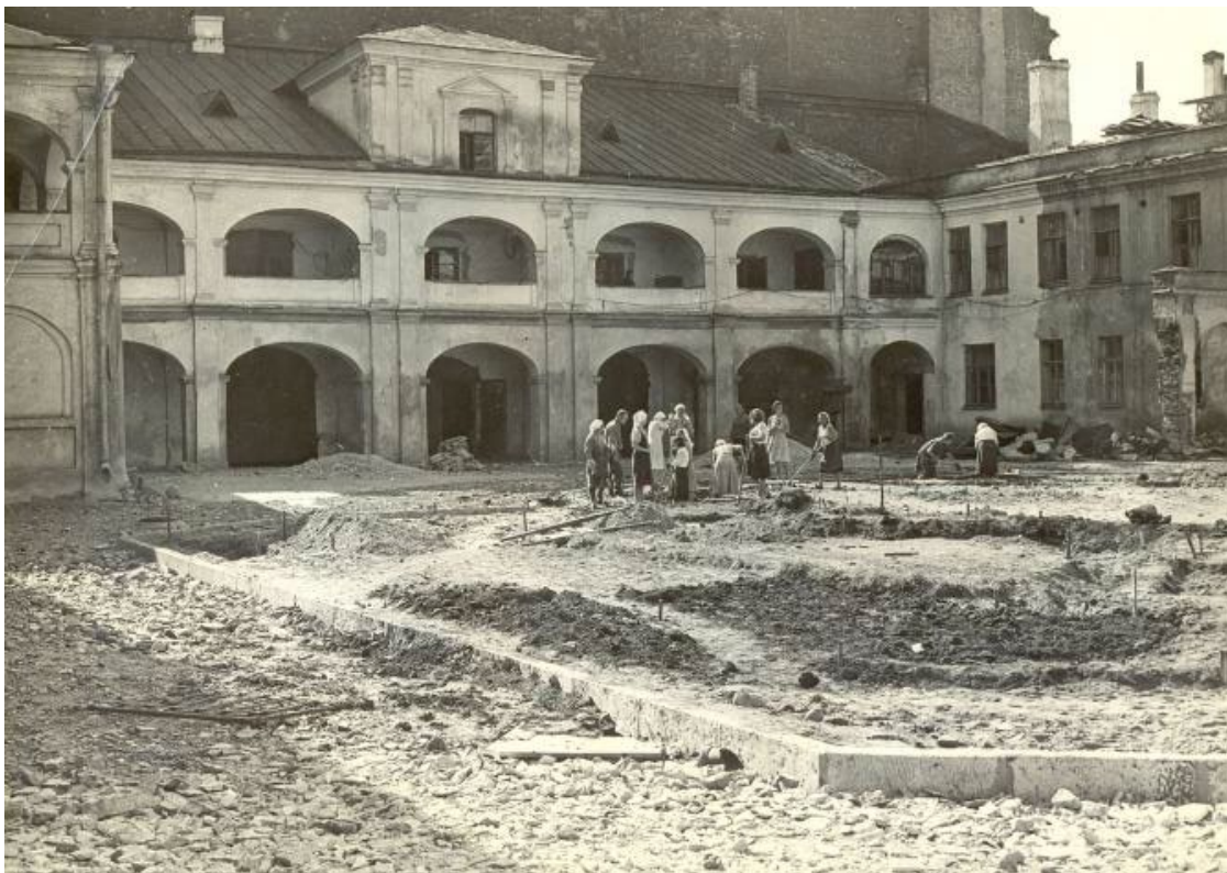
Илл. №13. Строительные работы во дворе дома на Мойке, 12. Партерные клумбы. 1947 г. ( https://pastvu.com/ )
