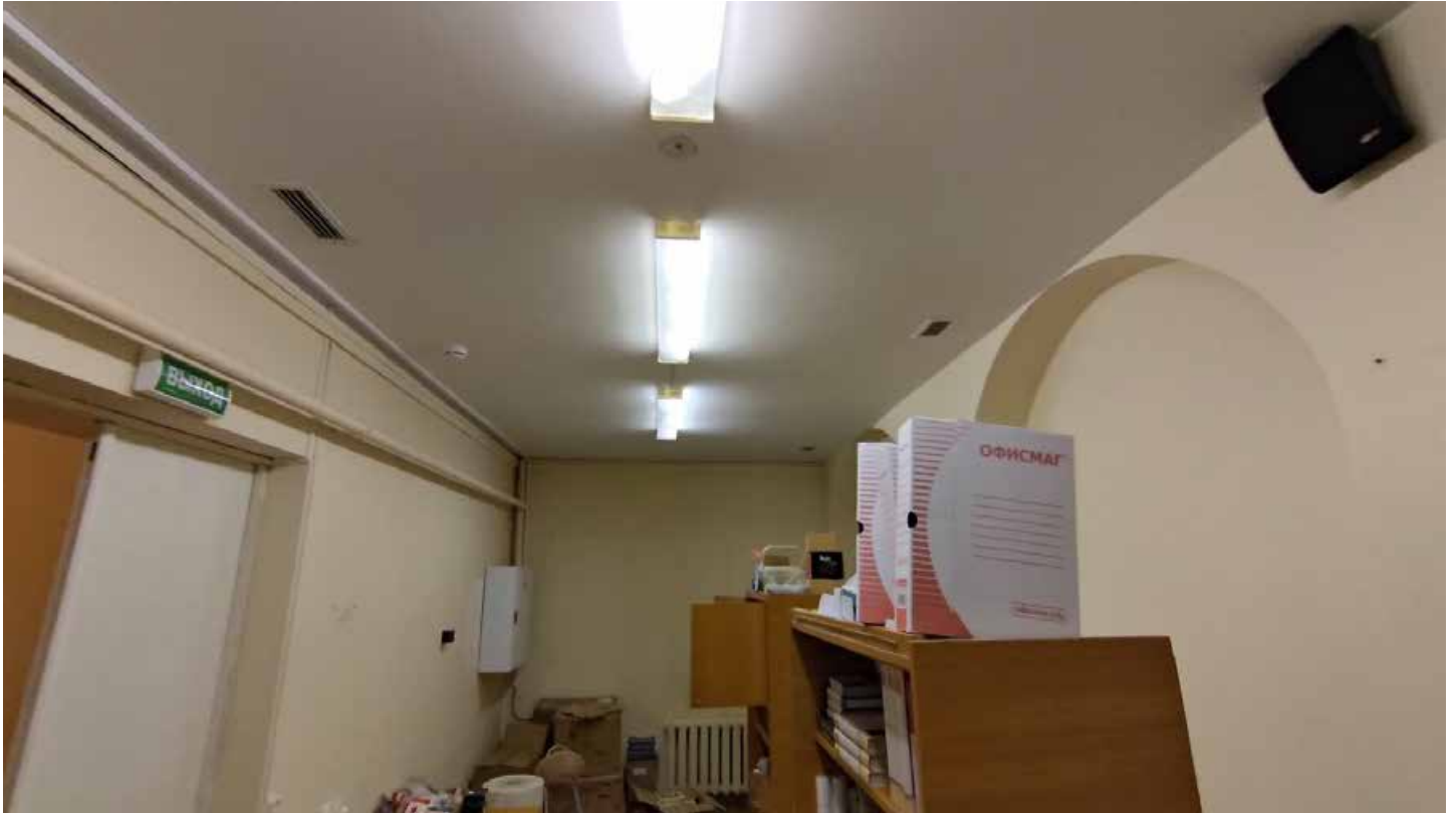
Фото 13. Заложенные арочные проёмы в помещении 1, 15-Н. Опорные пилоны. Фрагмент. Дата фотофиксации: 27.05.25.
