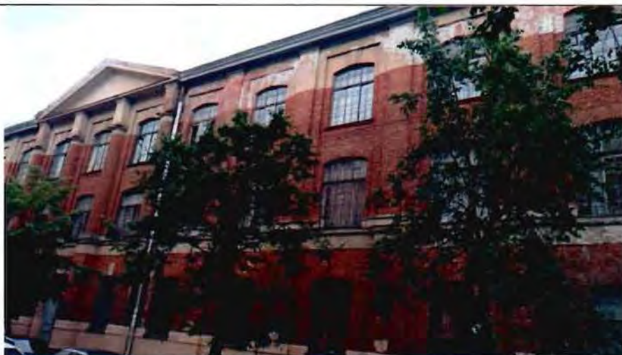
1. Фрагмент северо-восточного фасада
