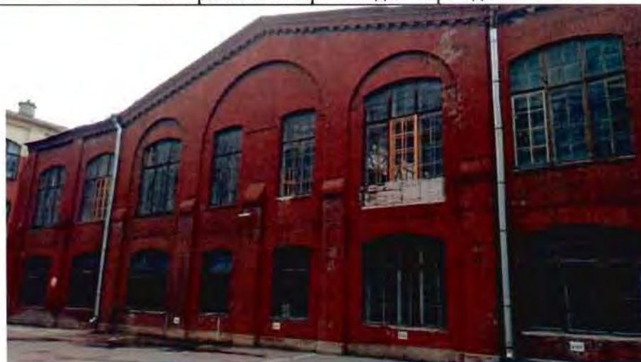
3. Фрагмент юго-западного фасада
