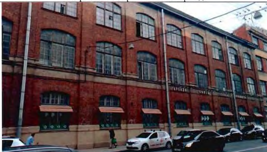
2. Фрагмент северо-западного фасада
