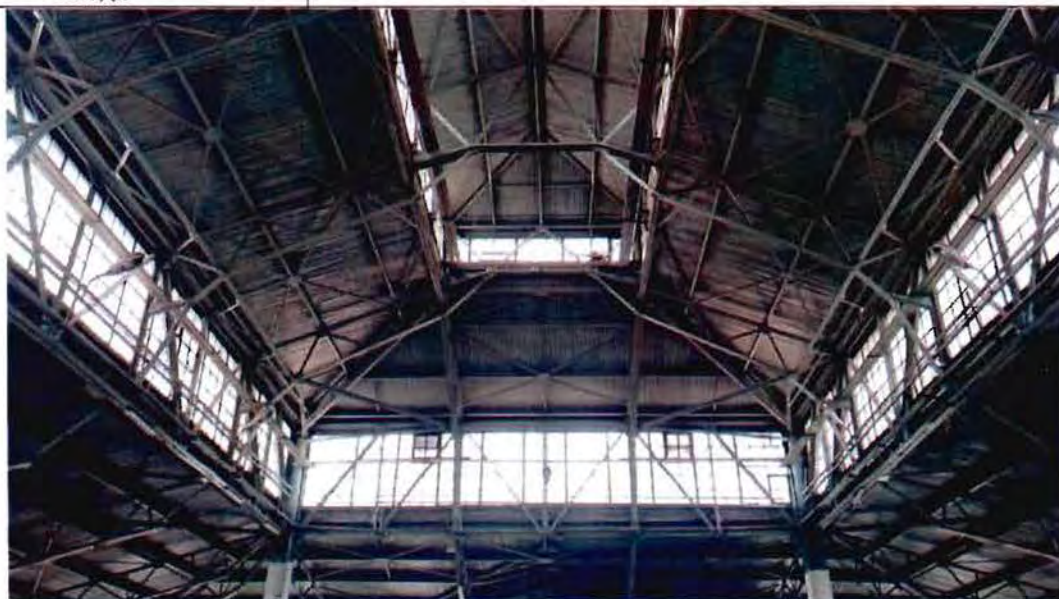
7. Металлоконструкции светового фонаря
