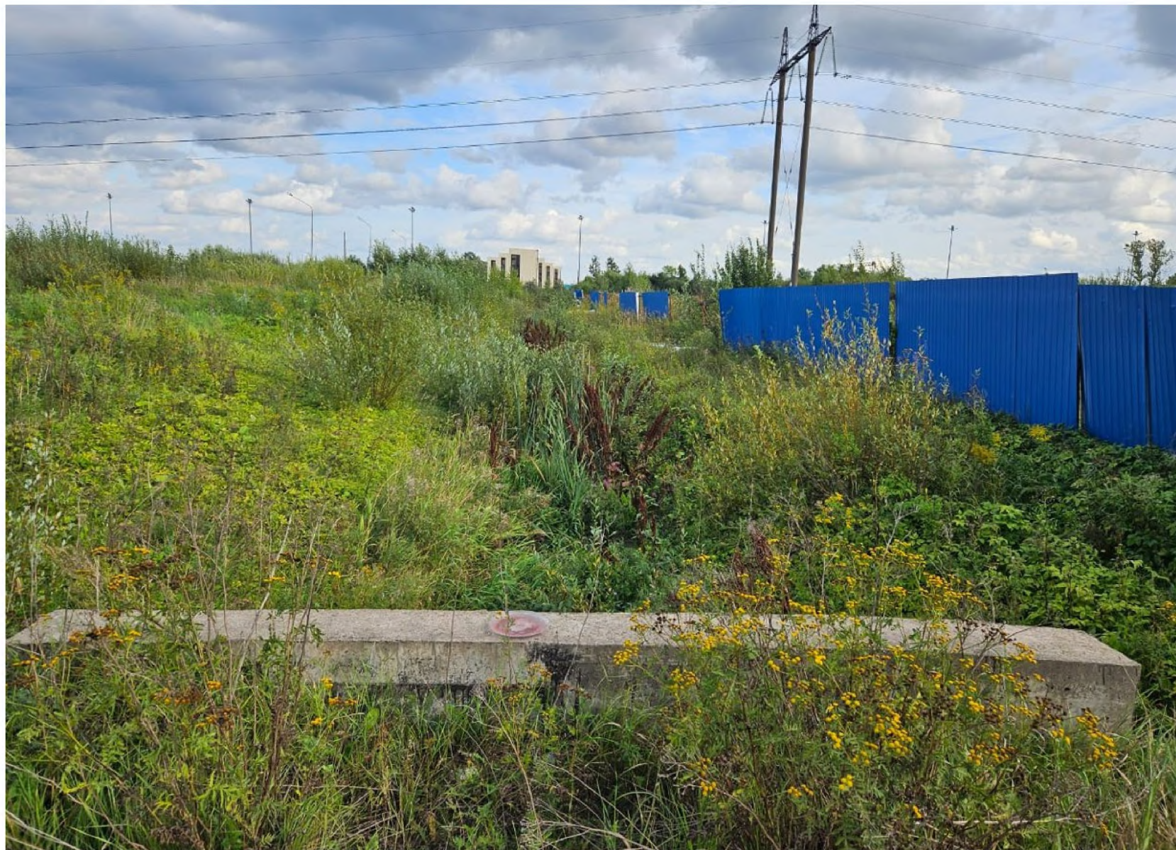
фото 5. ОКН ФЗ «Водовод Витоловский»
