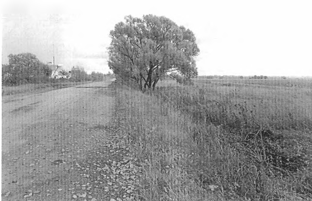
1. Участок водовода вдоль Рекхоловского шоссе.
