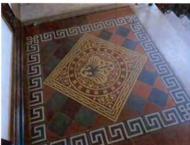
5. Покрытие пола верхнего уровня вестибюля.
