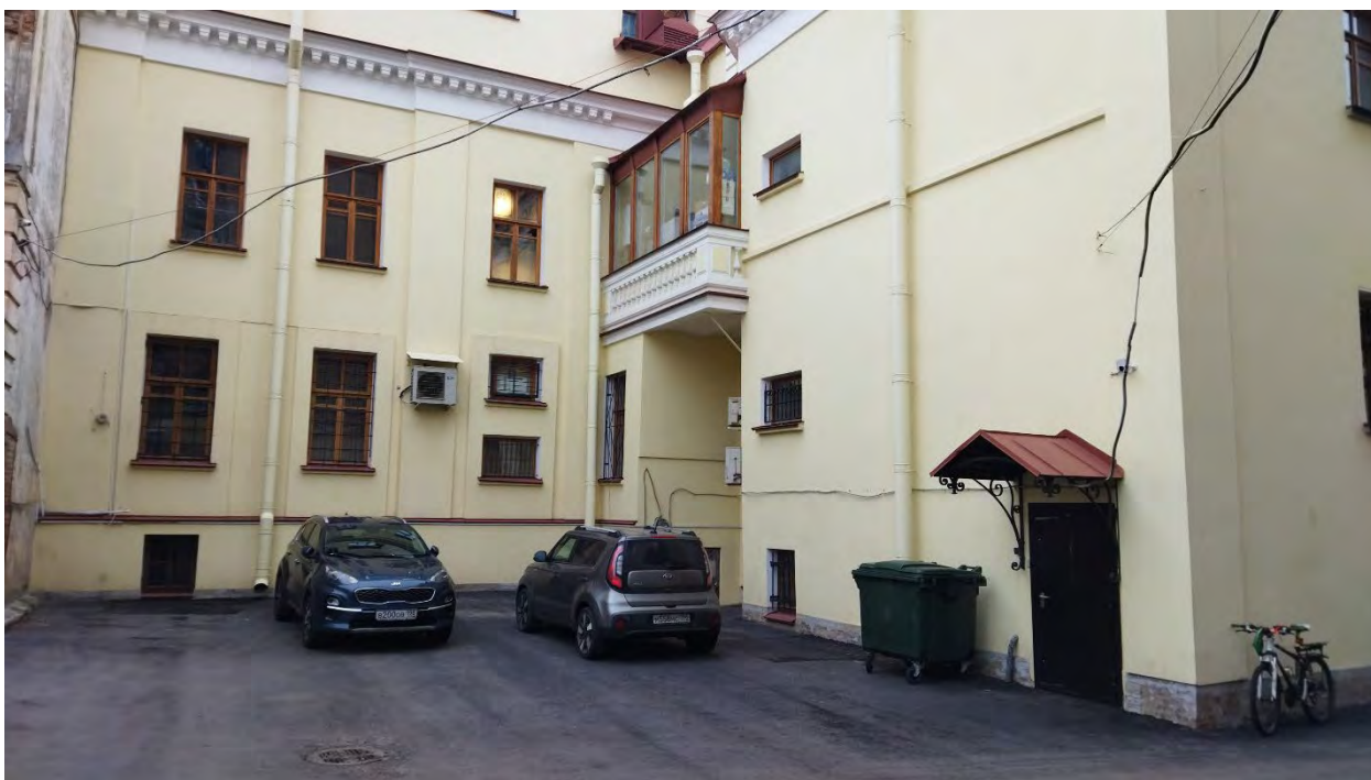
Фото 6. Дворовая территория. Вид на ОКН Ф Дом Боткина М.П.
