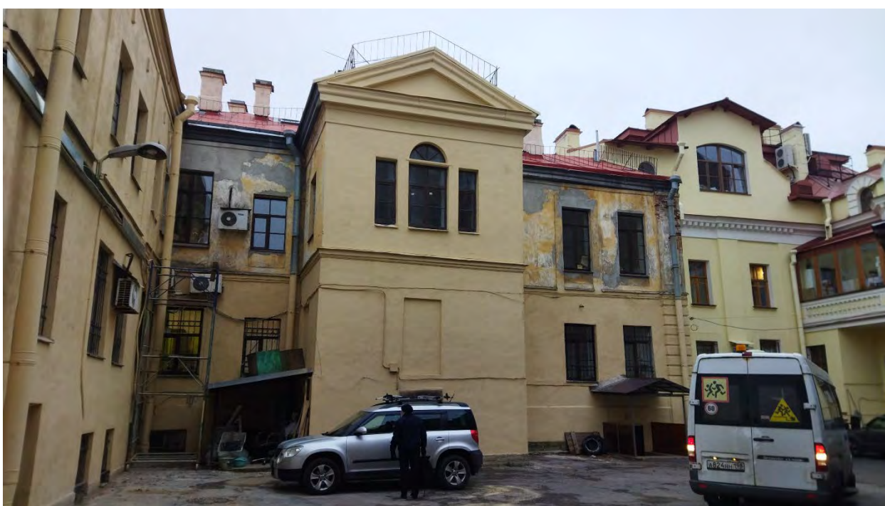
Фото 4. Дворовая территория. Вид на ОКН Ф Дом Боткина М.П.
