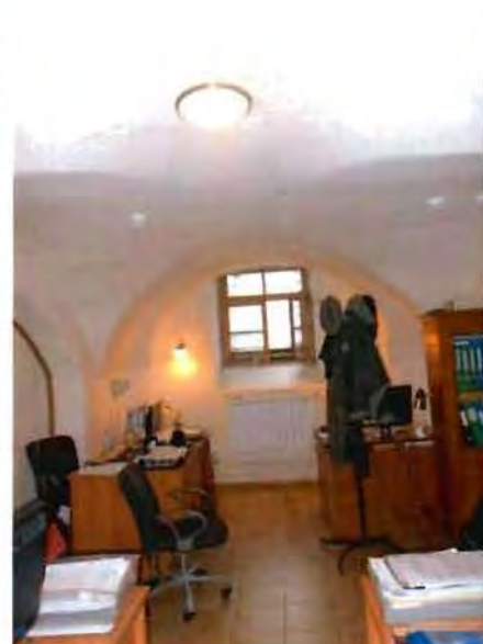
4. Свод цокольного этажа.
