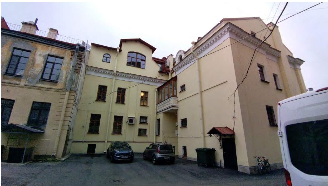
Фото 5. Дворовая территория. Вид на ОКН Ф Дом Боткина М.П.
