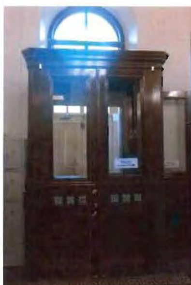
3. Тамбур главного входа.
