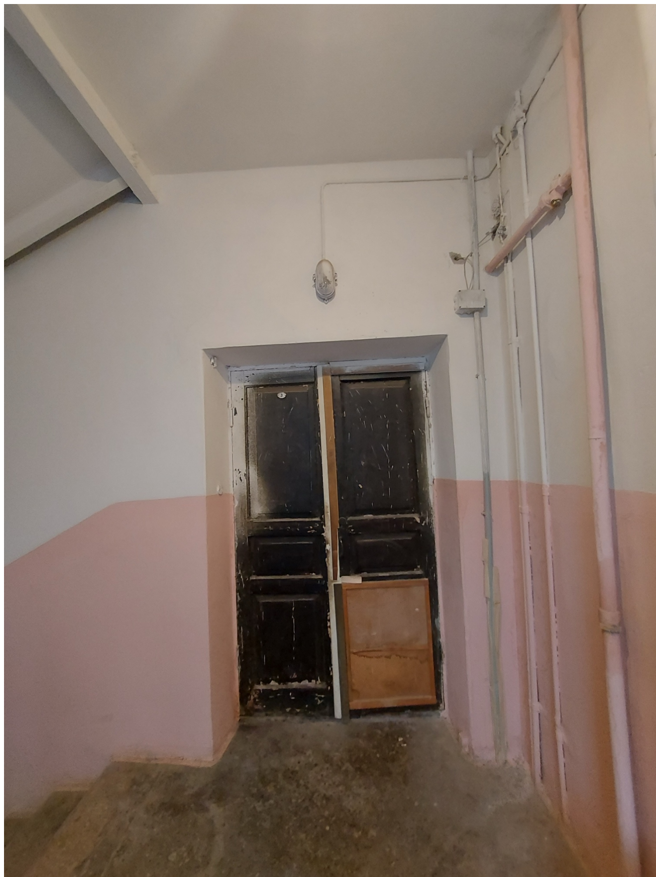
5. Входная дверь в квартиру 30 со стороны северной лестничной клетки.
