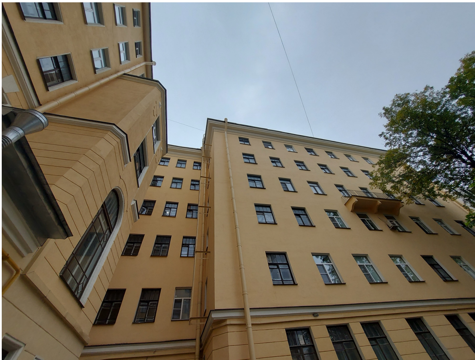
1. Общий вид дворового фасада.
