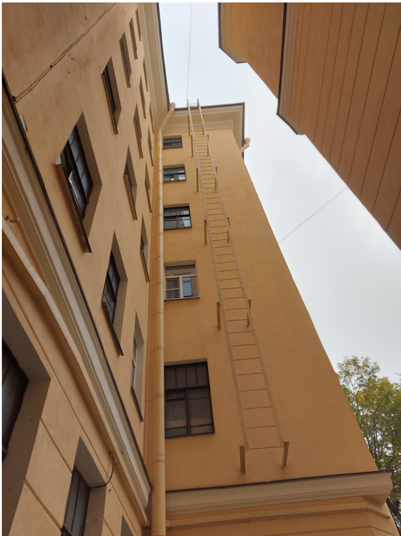
2. Фрагмент дворового фасада.
