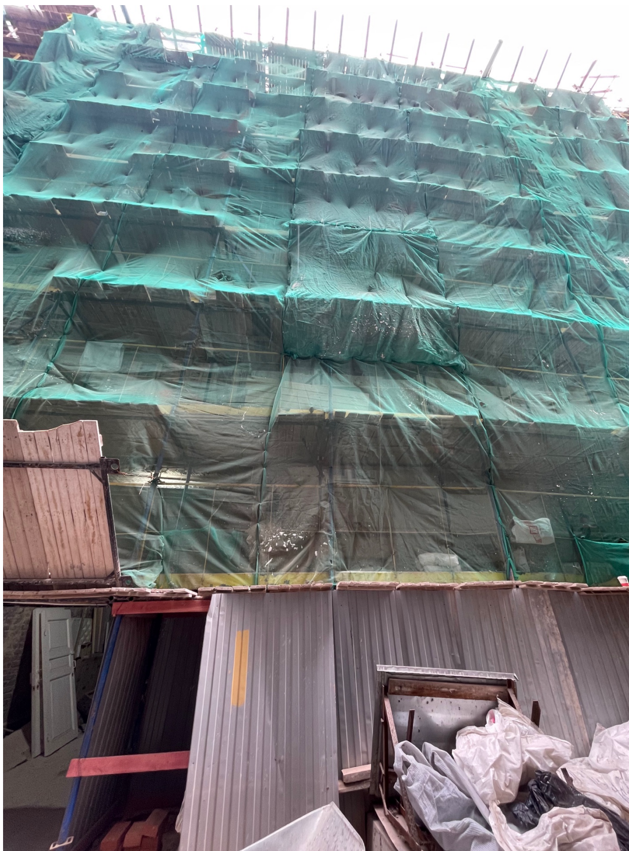
1. Фрагмент дворового фасада.
