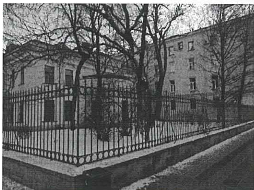
1. Ограда общий вид
