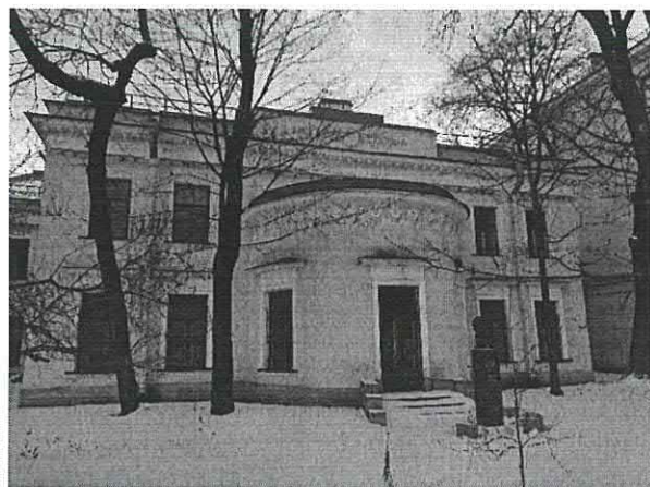
6. Лицевой фасад со стороны Московского пр.
