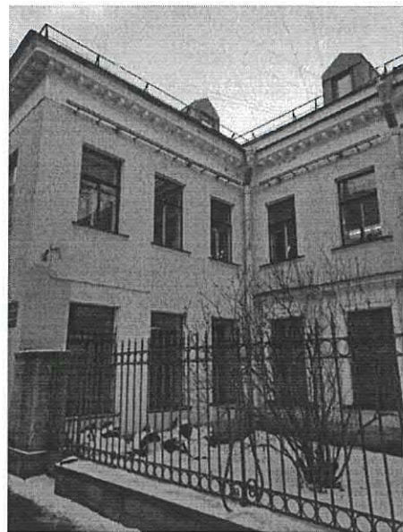
4. Фрагмент лицевого фасада
