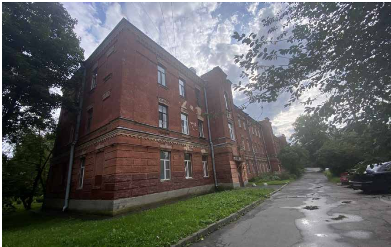
Фот. 9. Вид на ОКН «Здание казармы» по адресу: г. Пушкин, ул. Саперная, д. 16, входящий в состав ансамбля «Офицерская артиллерийская школа», дворовый фасад
