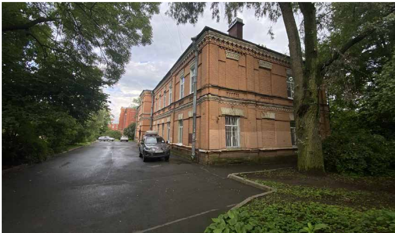
Фот. 4. Вид на ОКН «Здание казармы» по адресу: г. Пушкин, ул. Саперная, д. 18, входящий в состав ансамбля «Офицерская артиллерийская школа», дворовый фасад, вид на территорию выявленного объекта культурного наследия
