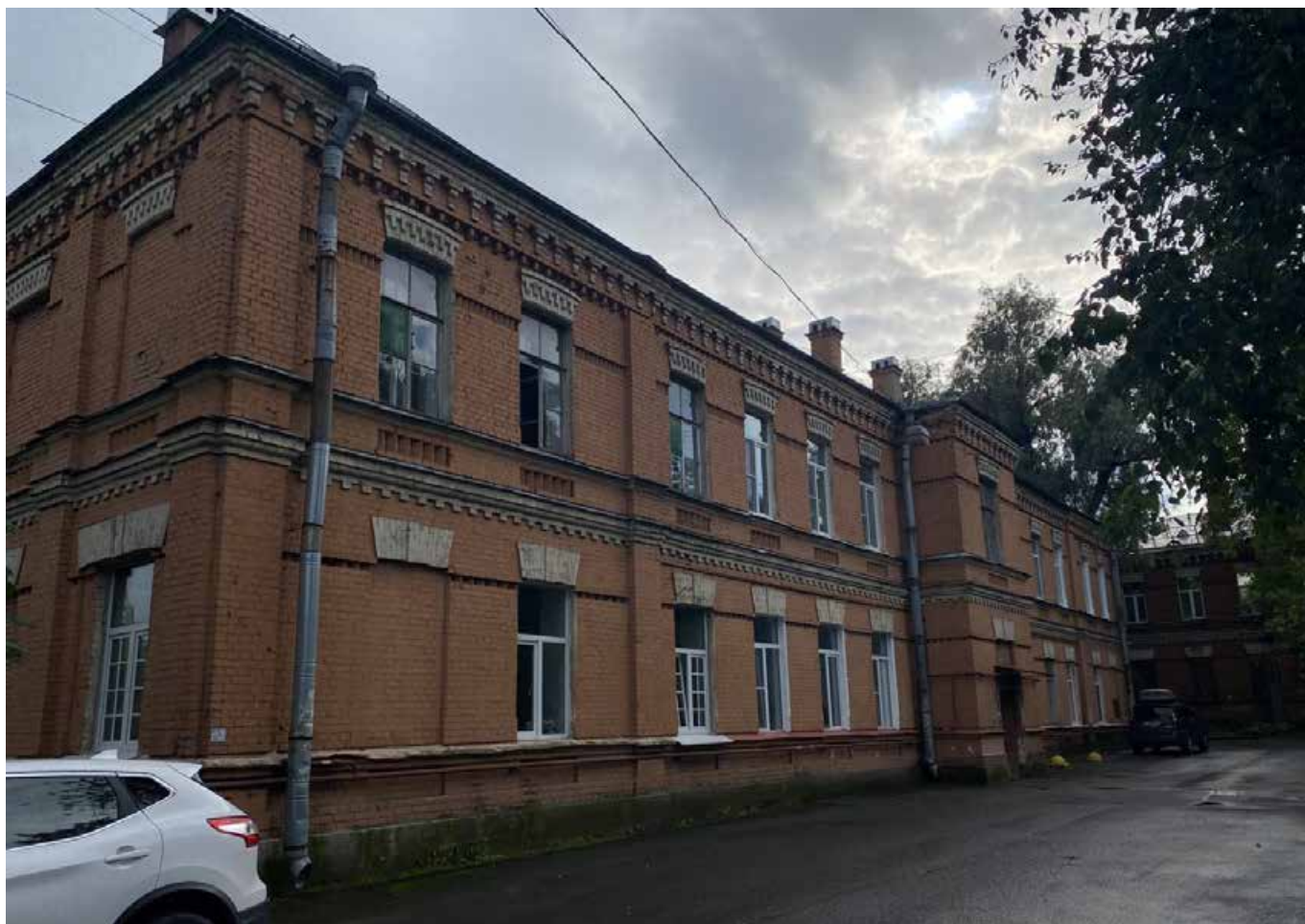
Фот. 3. Вид на ОКН «Здание казармы» по адресу: г. Пушкин, ул. Саперная, д. 18, входящий в состав ансамбля «Офицерская артиллерийская школа», дворовый фасад
