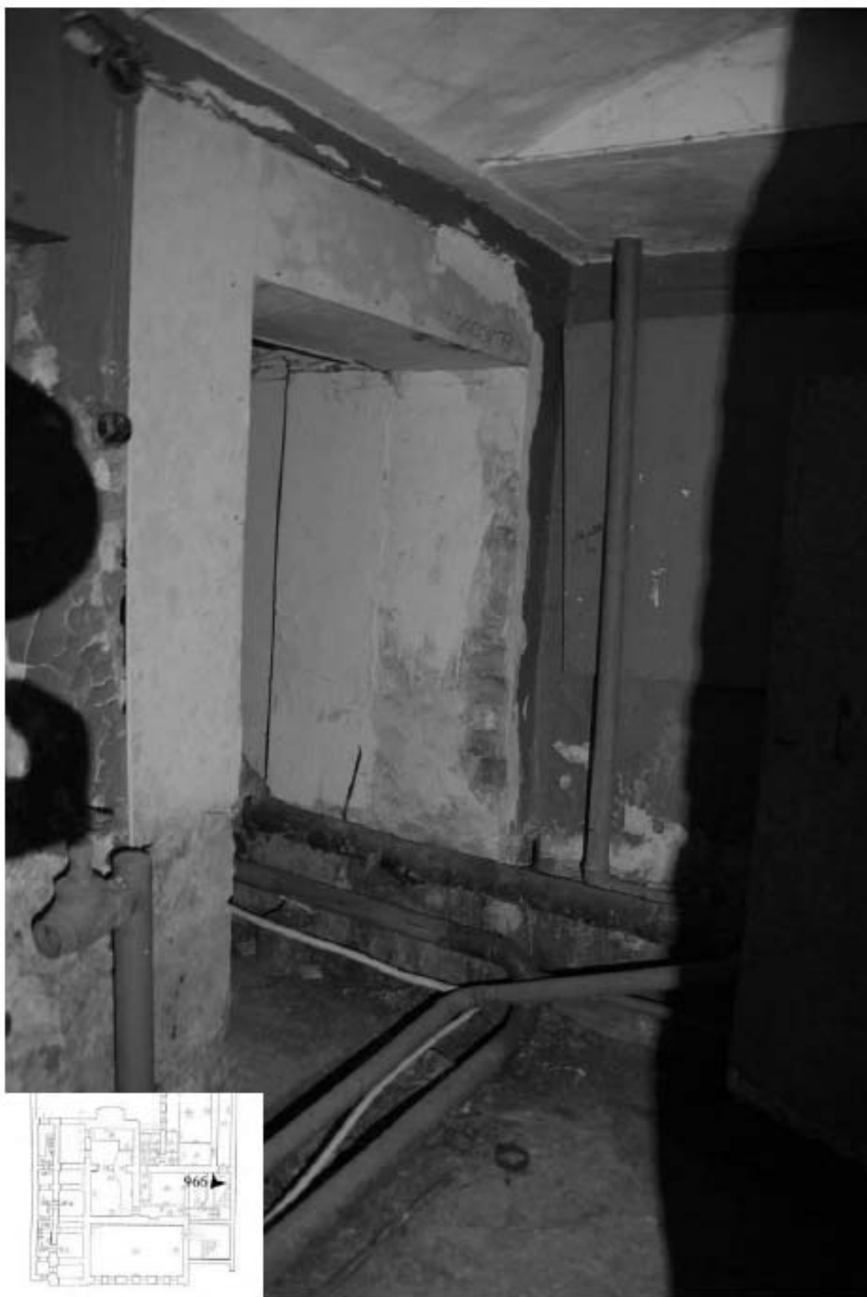
966. Подвал. Интерьер помещения 29-Н.
