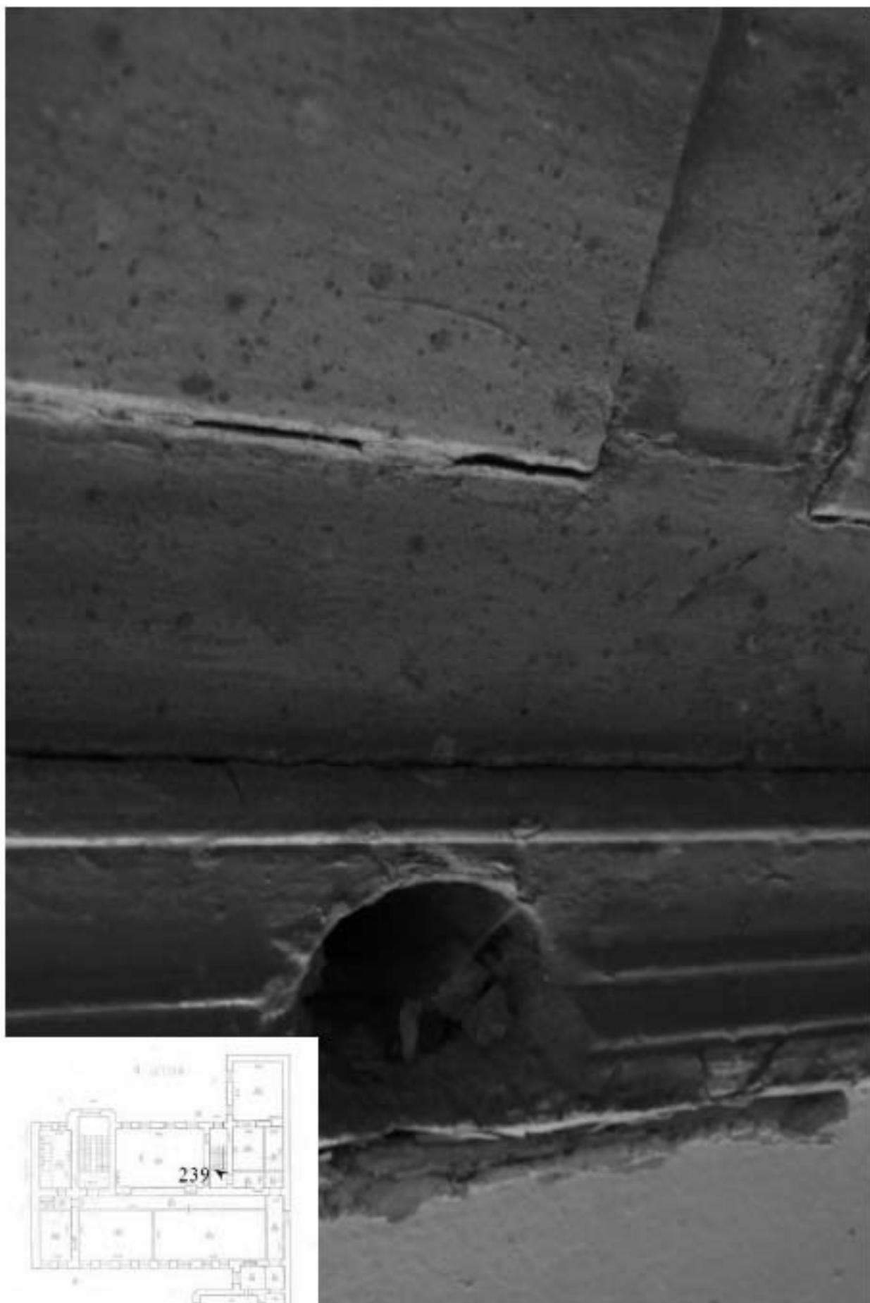
239. Лестница 4ЛК. Отверстие дверного звонка.
