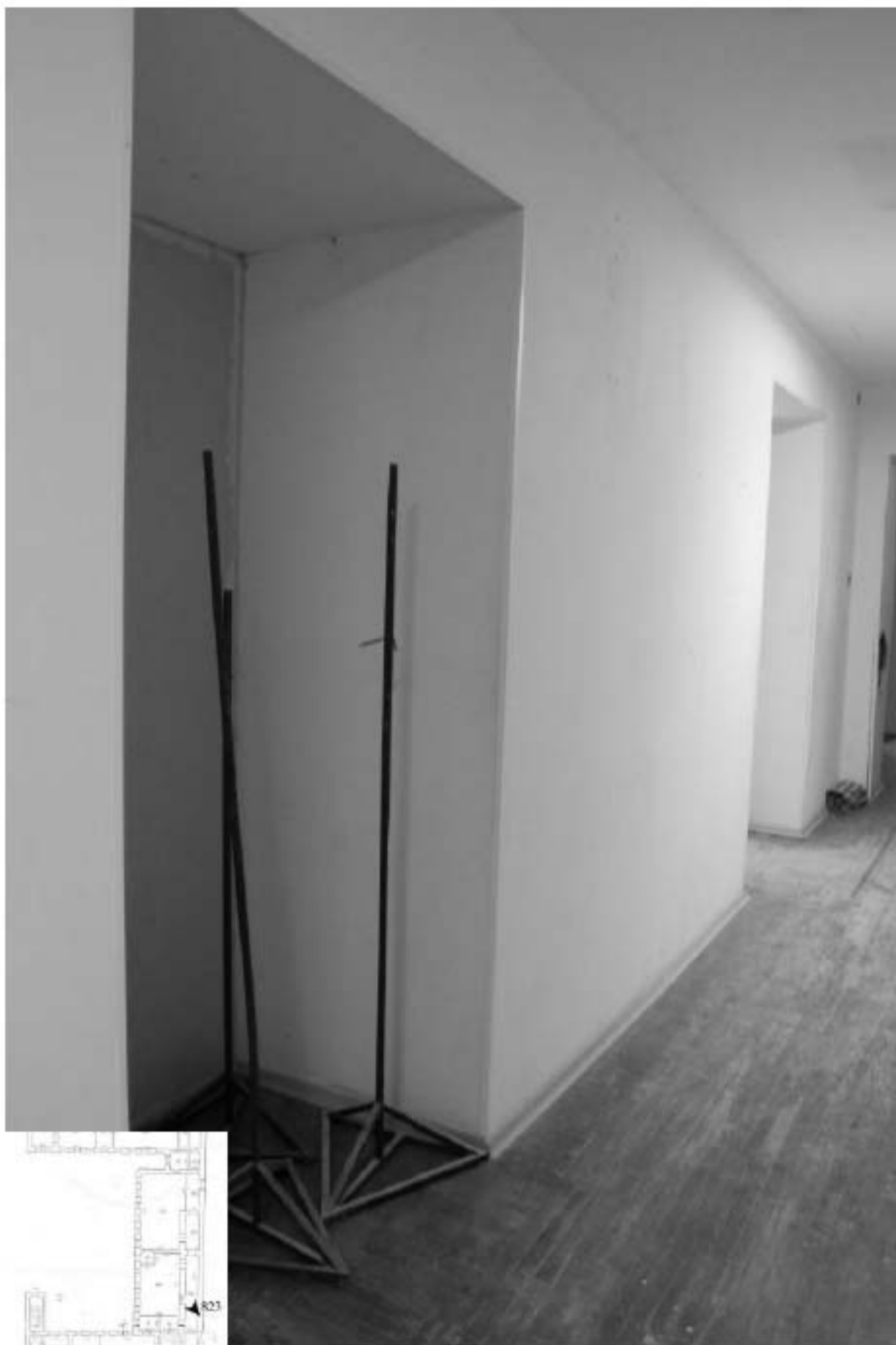
823. Этаж 5, помещение 19-Н. Вид коридора.
