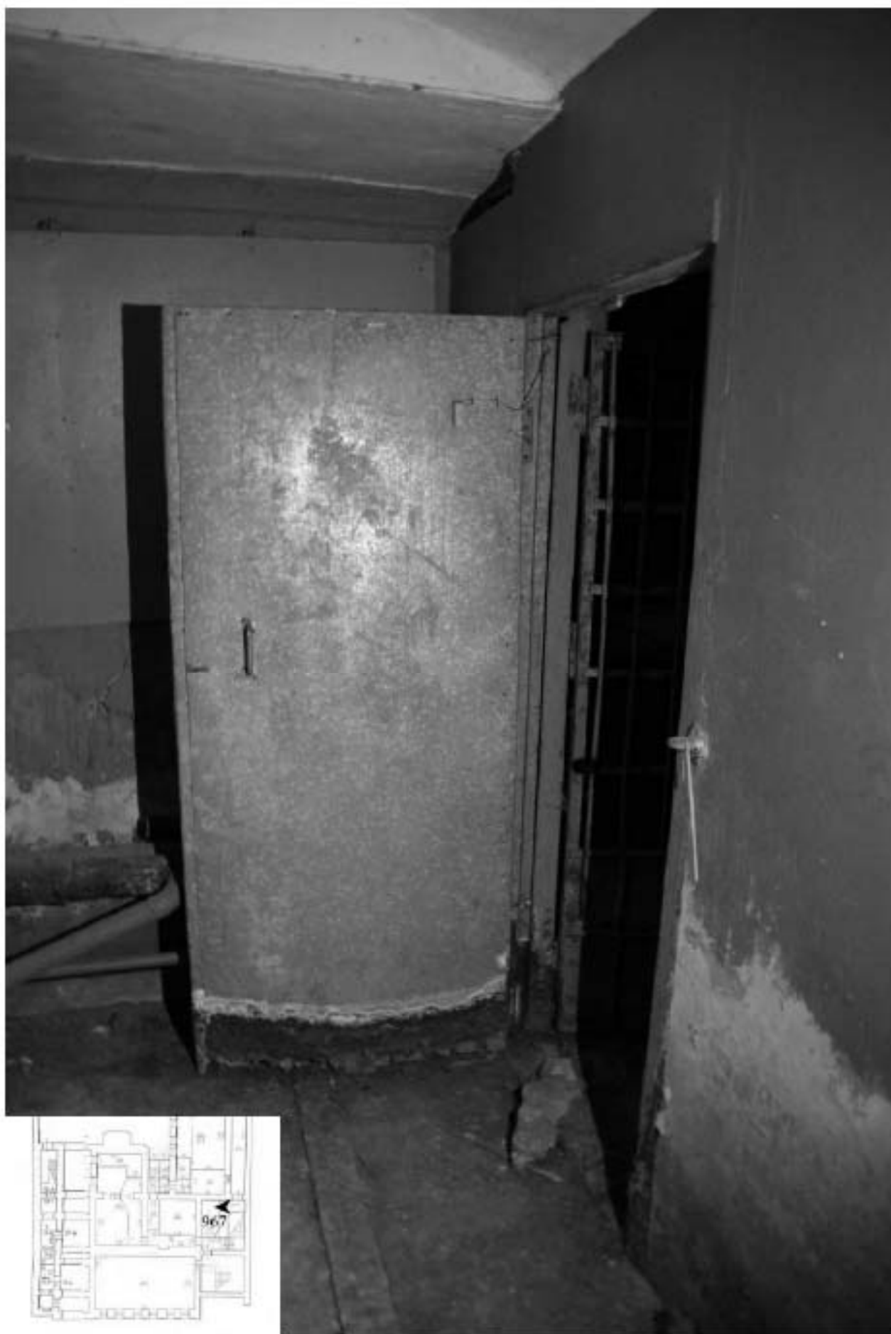
967. Подвал. Интерьер помещения 29-Н.
