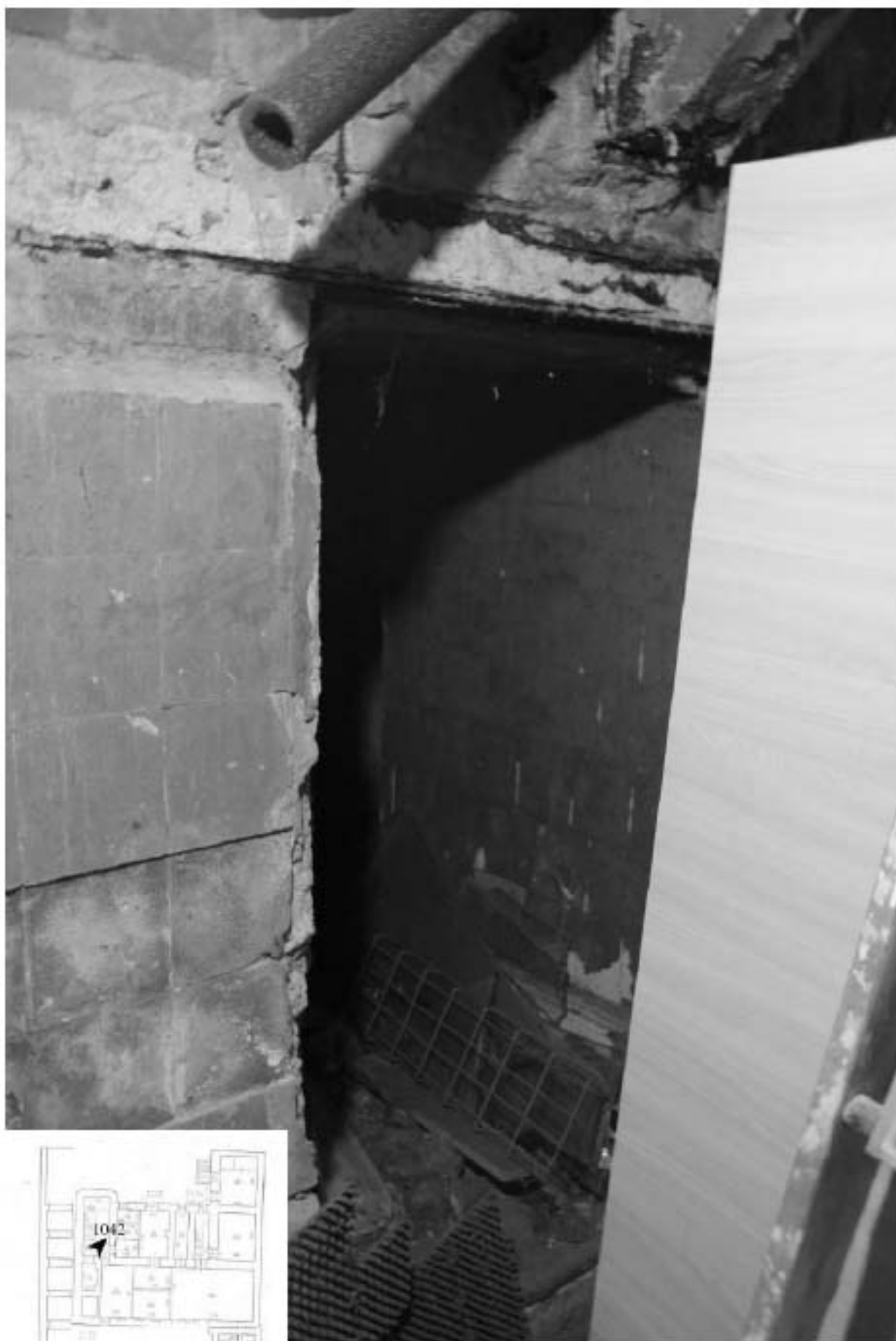
1042. Подвал. Вход в помещение 5-Н.
