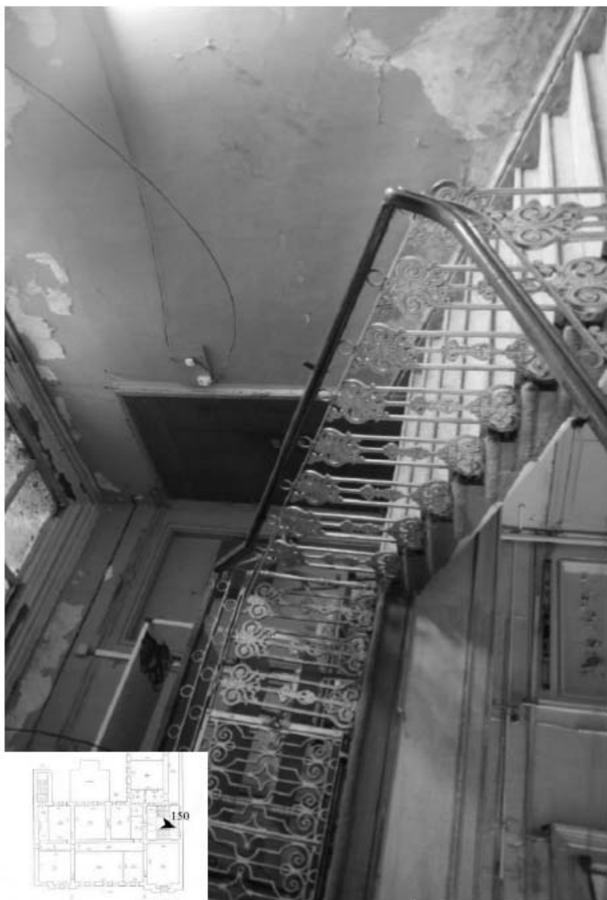
150. Вид на лестничную площадку 5 этажа.
