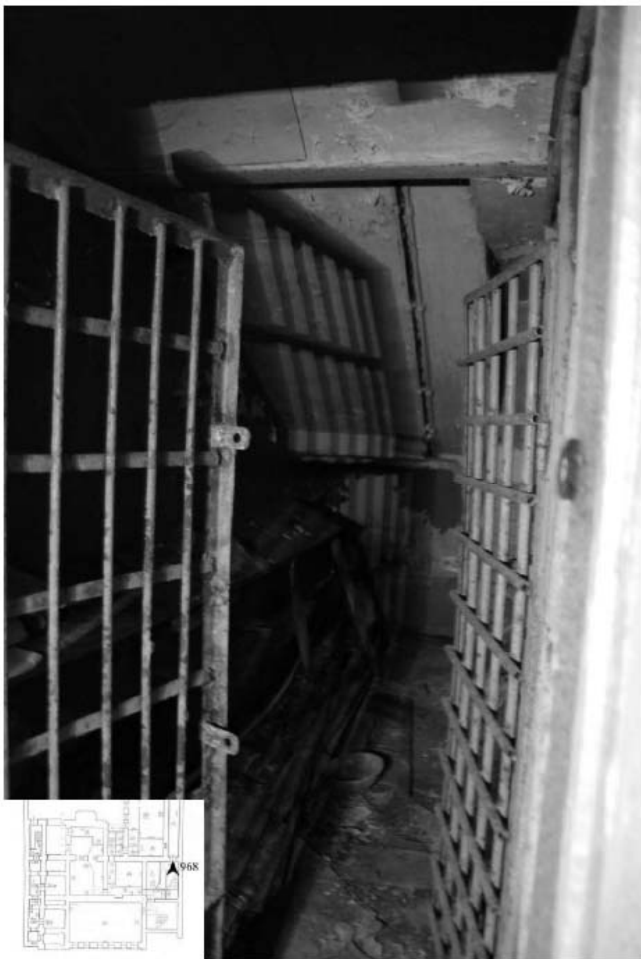
968. Подвал. Помещение 29-Н. Интерьер пространства под лестницей.
