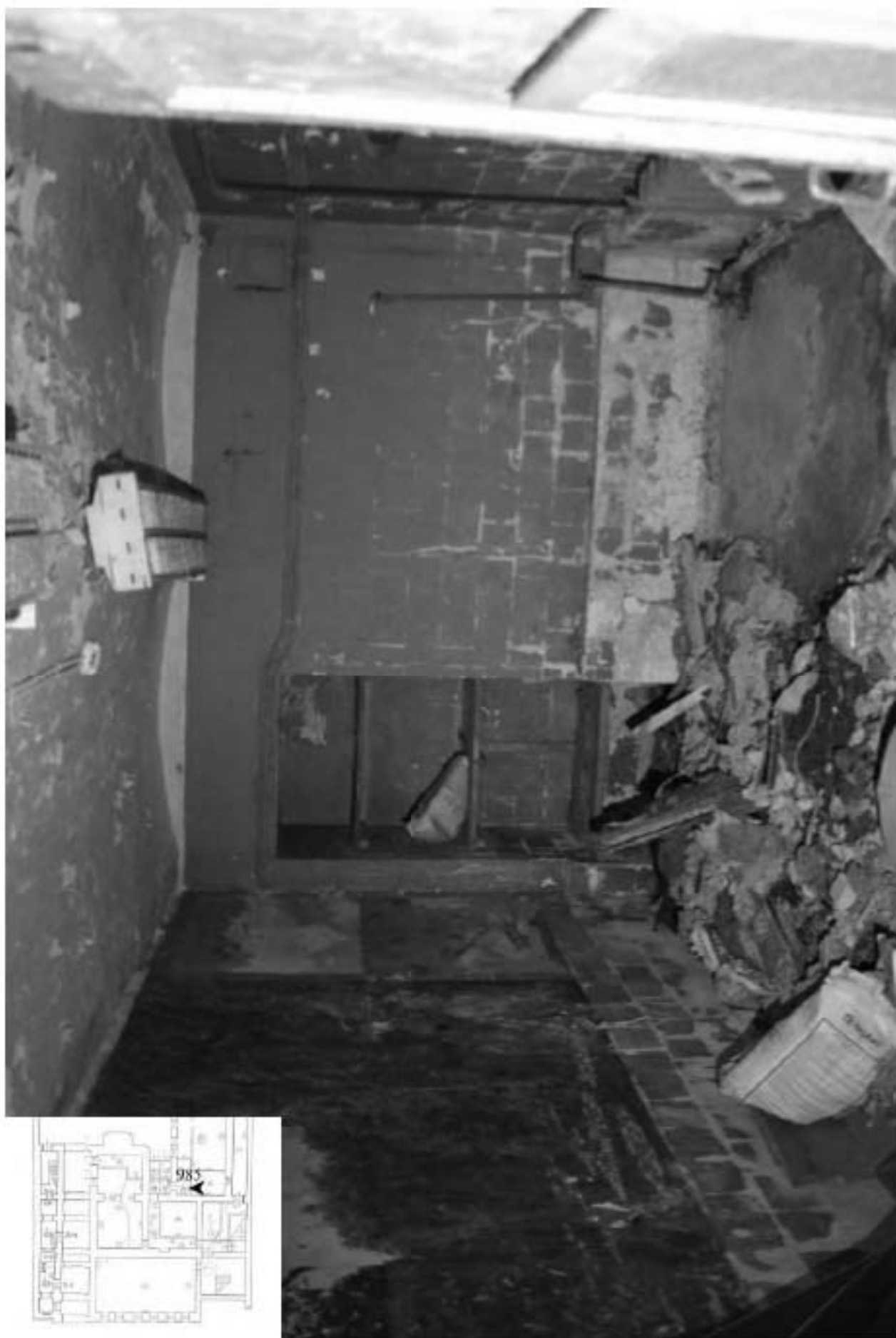
985. Подвал, помещение 6-Н. Интерьер комнаты 12,1 кв.м.
