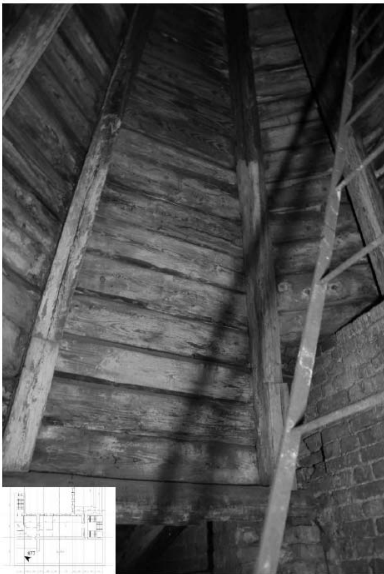
877. Этаж 5, интерьер чердака.
