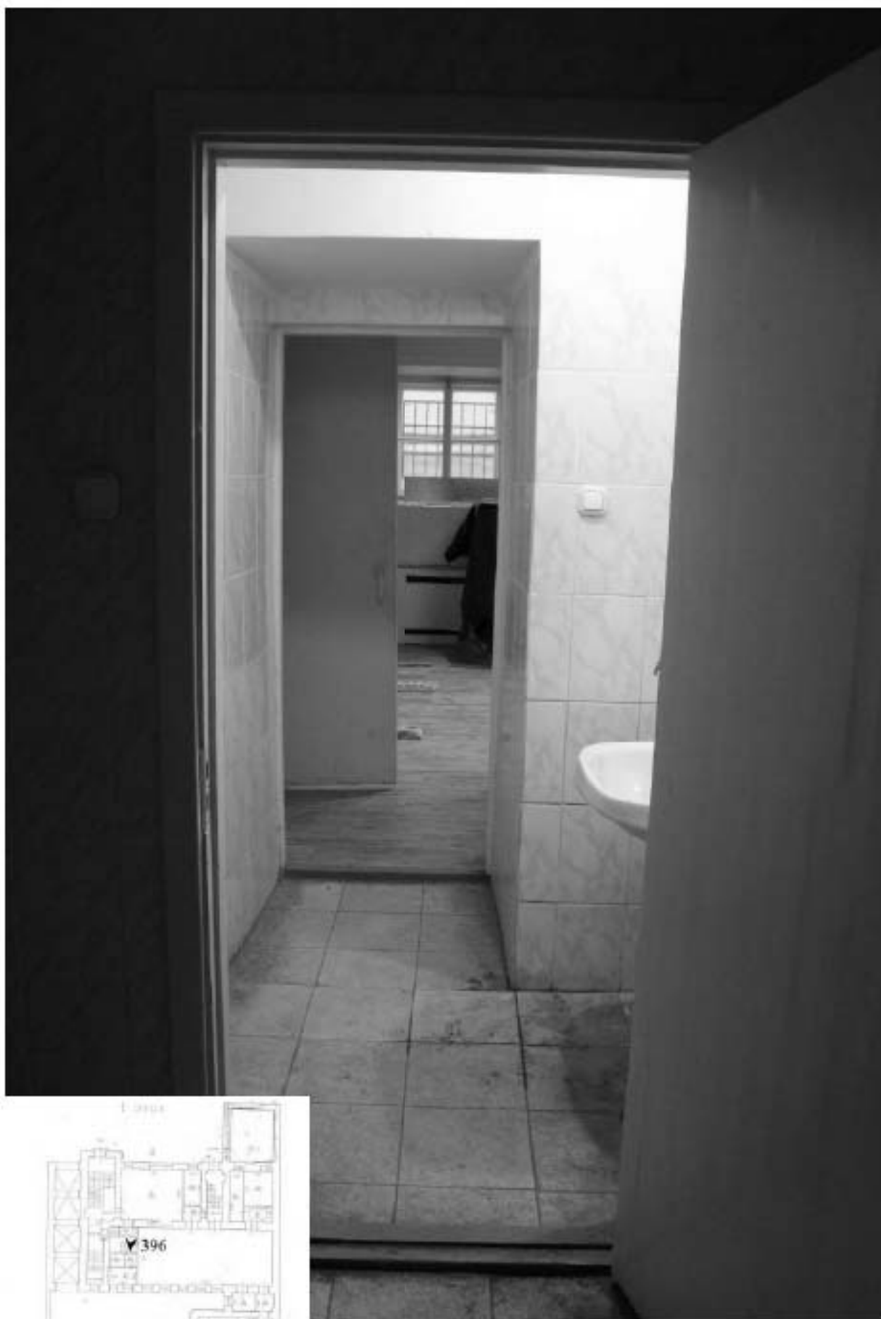
396. Этаж 1, помещение 15-Н. Интерьер душевой.
