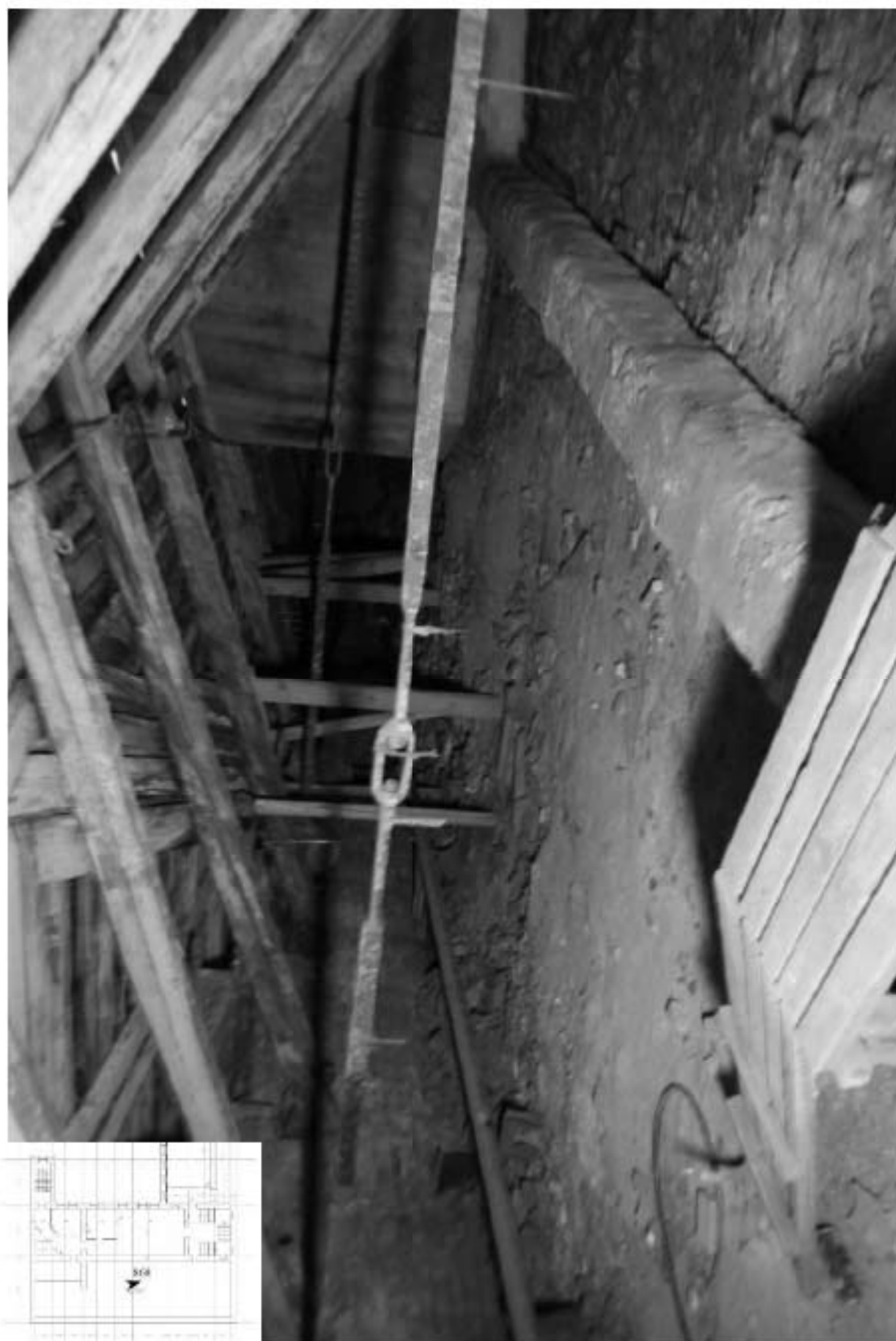
868. Этаж 5, интерьер чердака.
