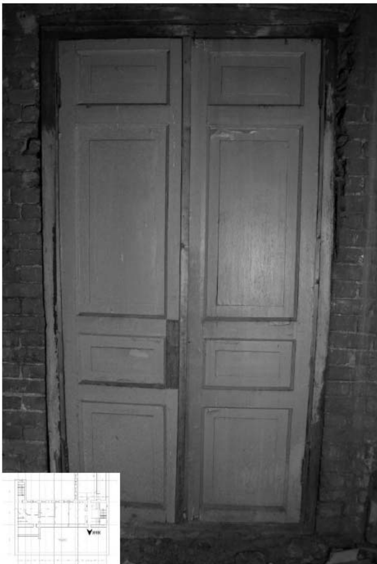
898. Этаж 5, интерьер чердака.
