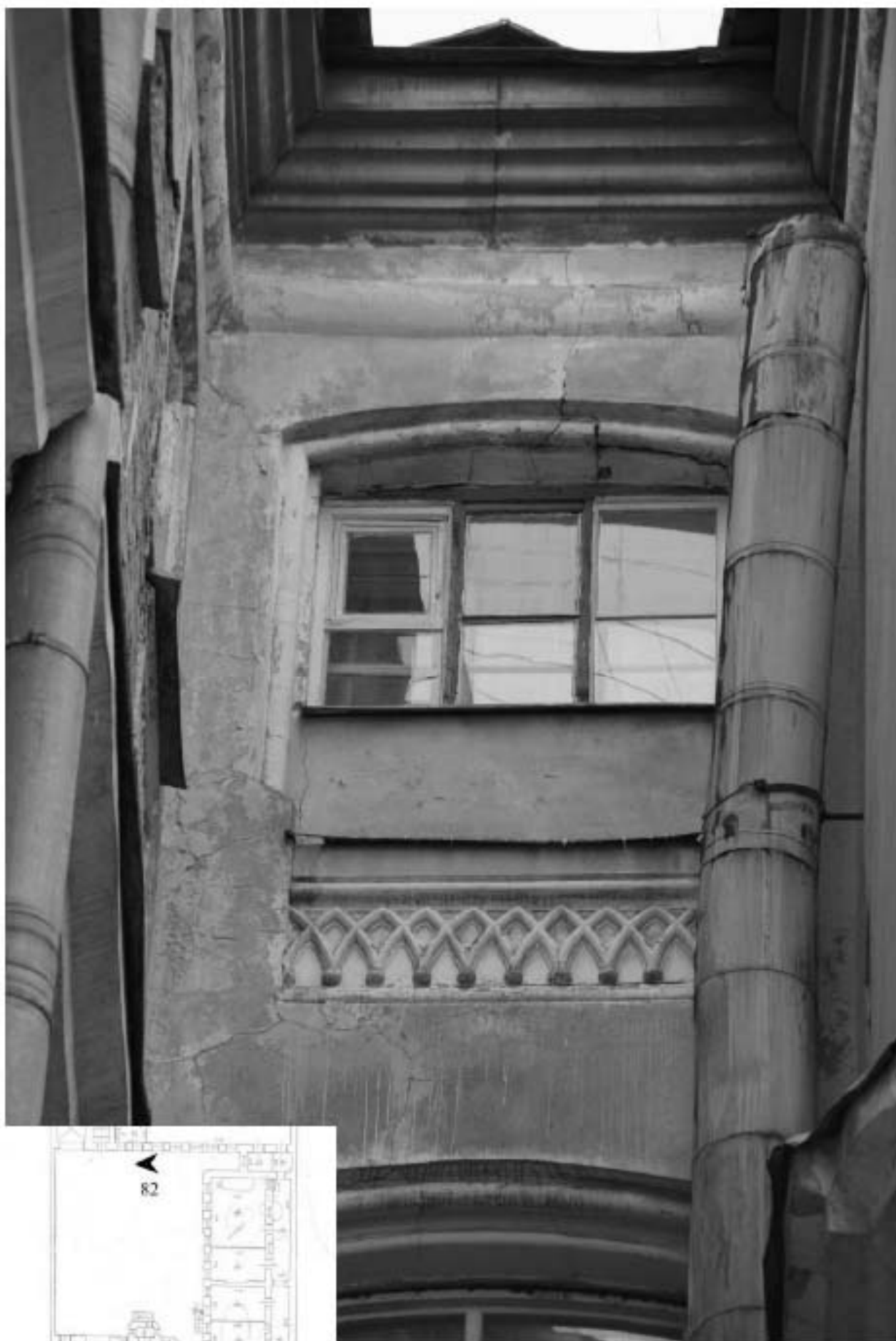
82. Фрагмент дворового фасада.
