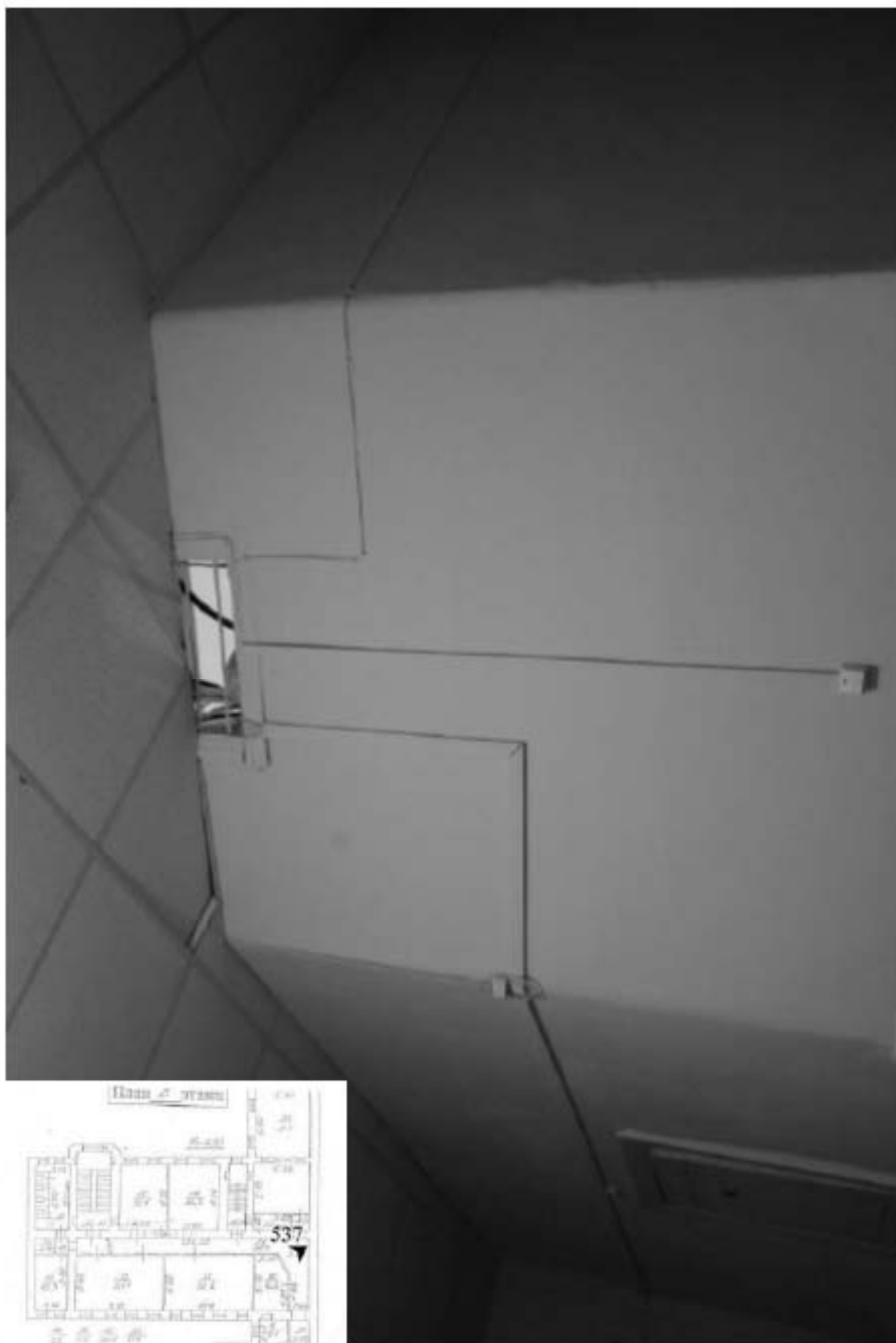
537. Этаж 2, помещение 16-Н. Вид коридора.
