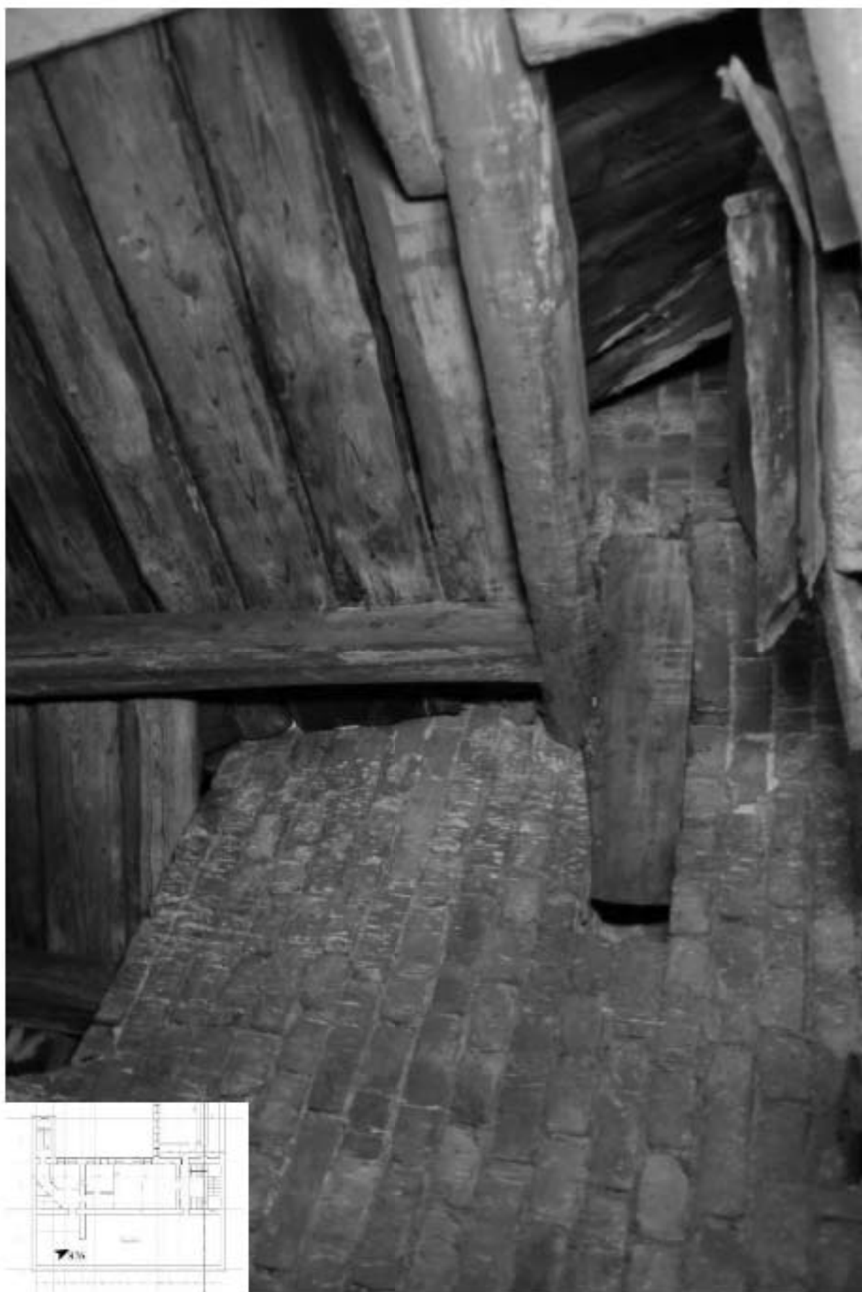
876. Этаж 5, интерьер чердака.
