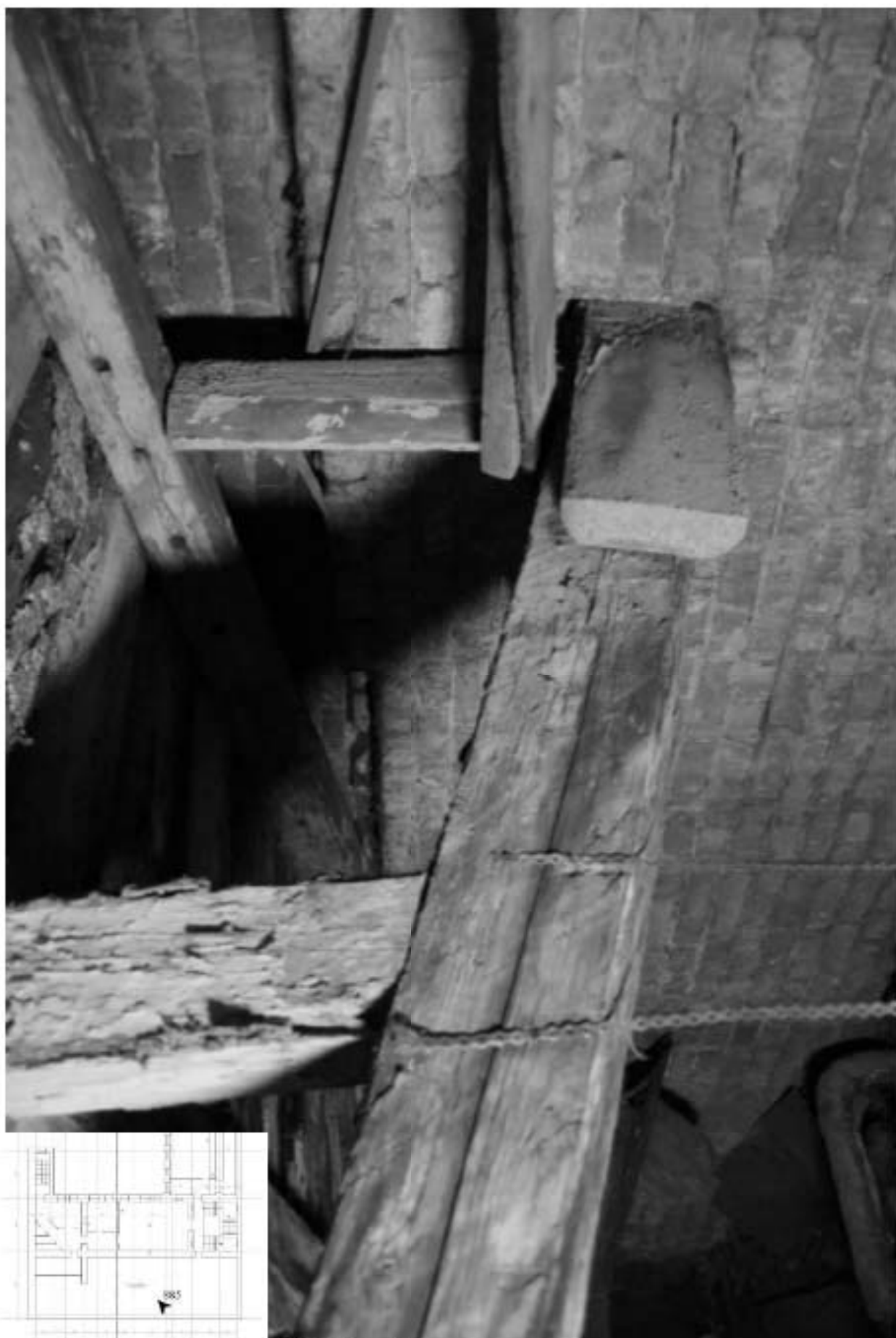
885. Этаж 5, интерьер чердака.
