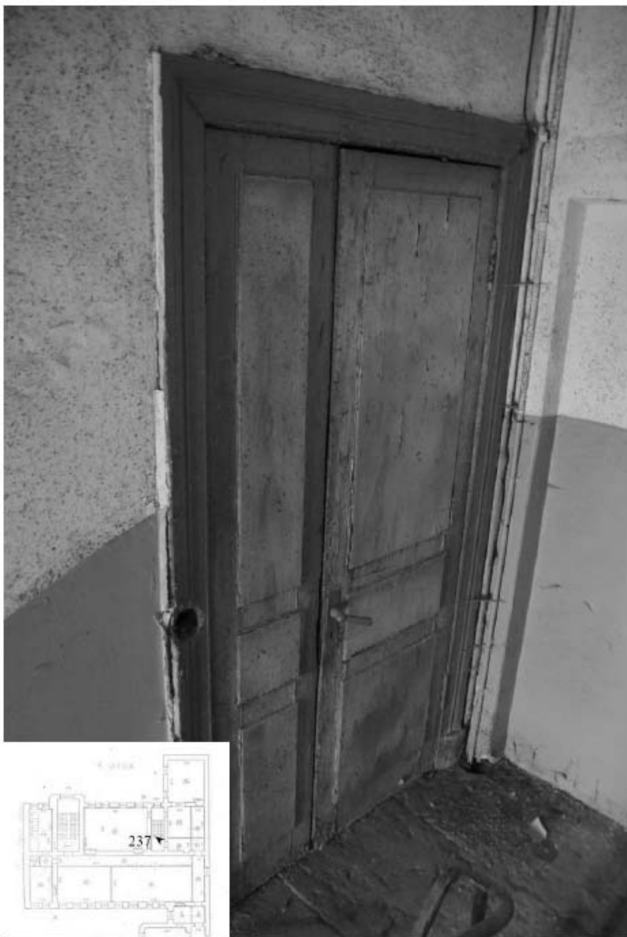
237. Лестница 4ЛК. Входная дверь лестничной площадки 4 этажа.
