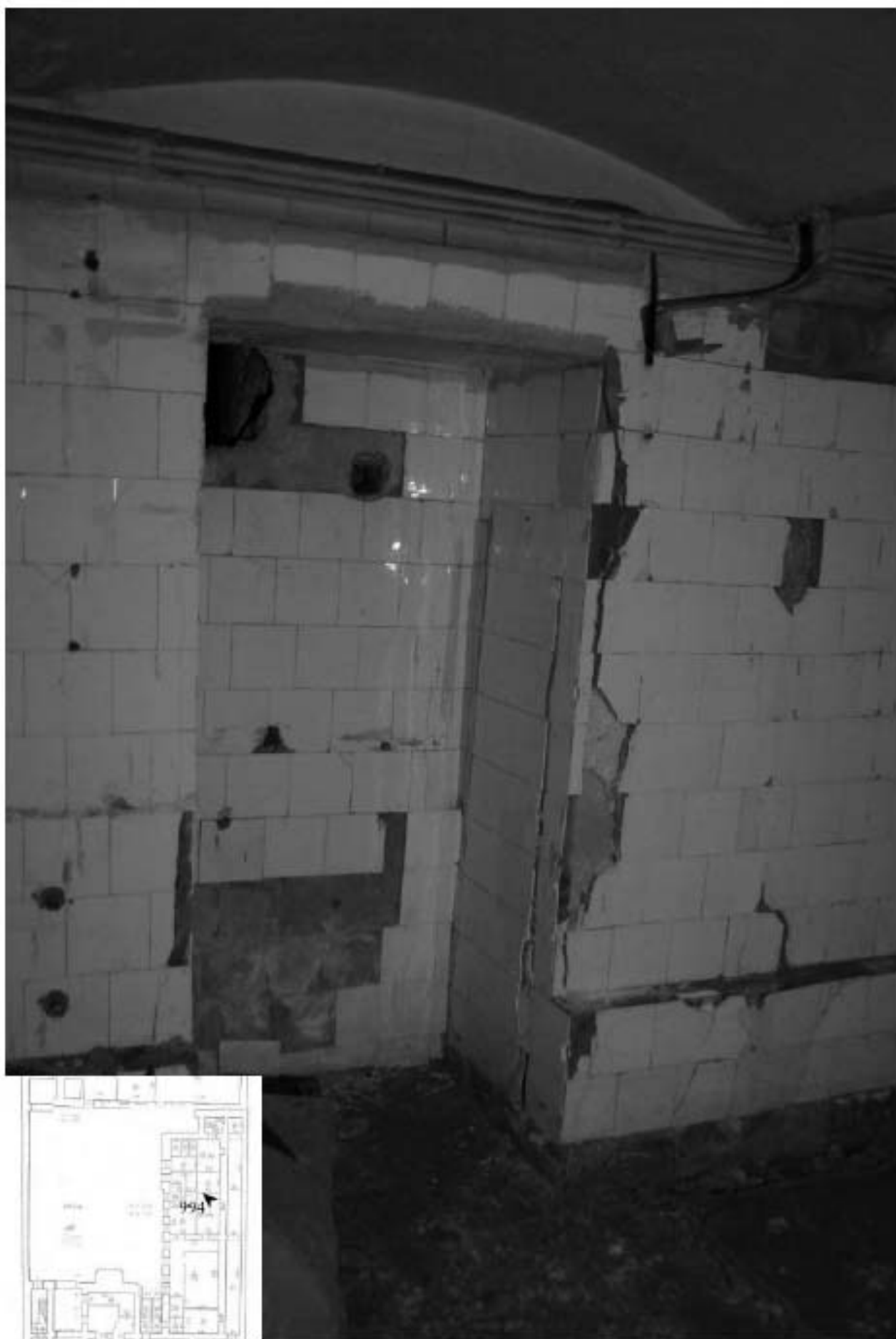
994. Подвал, помещение 6-Н. Интерьер комнаты 14,2 кв.м.
