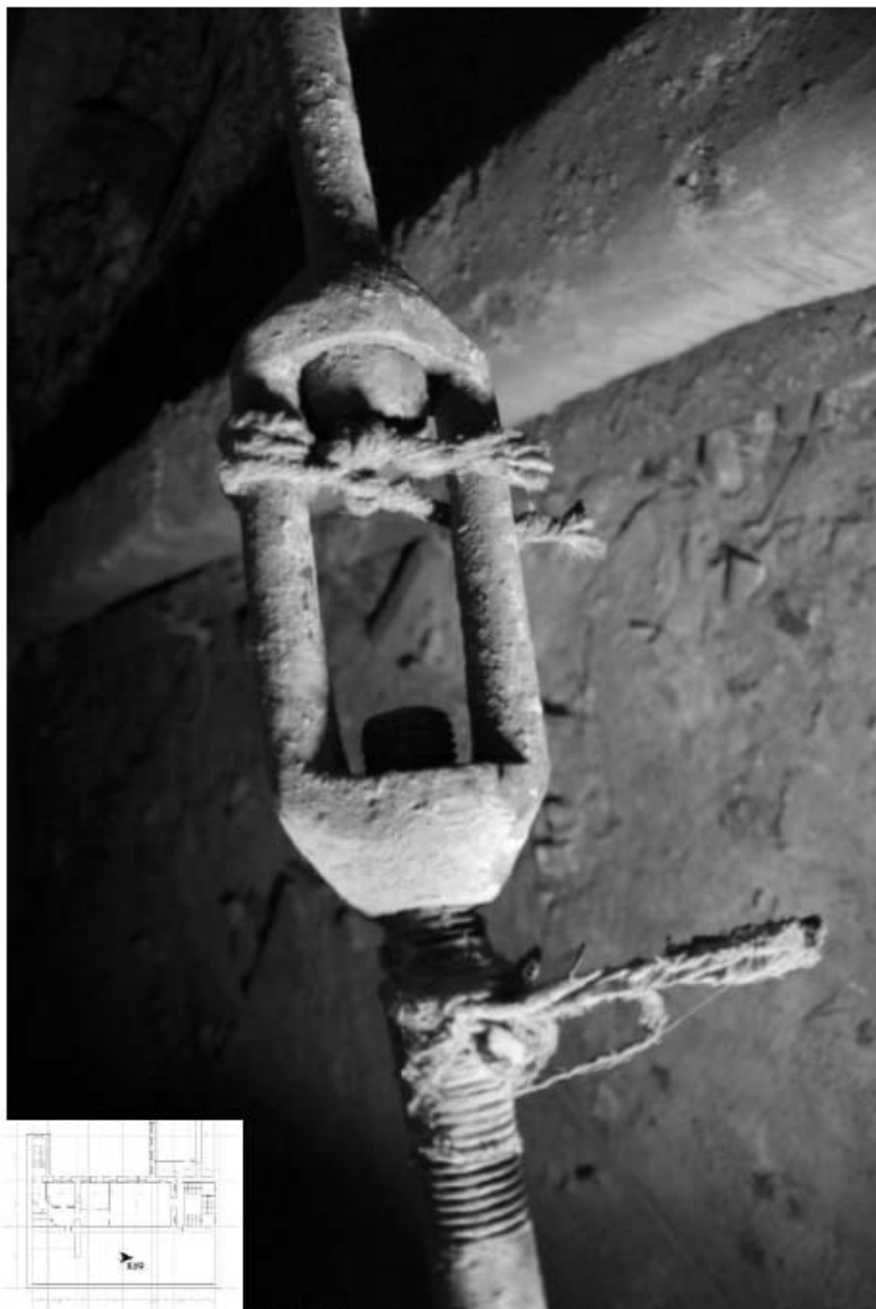
869. Этаж 5, интерьер чердака.
