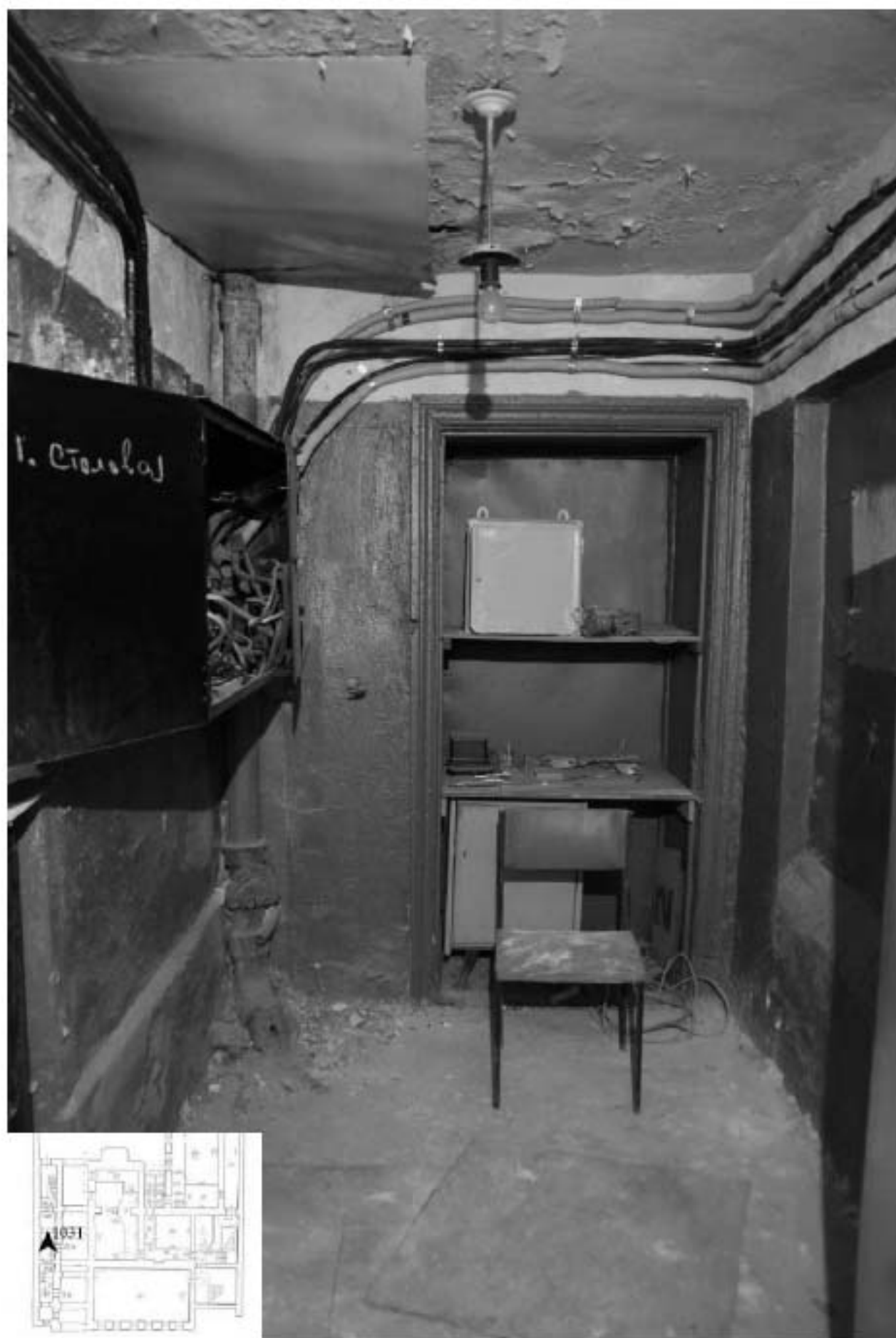
1031. Подвал, интерьер помещения 10-Н.
