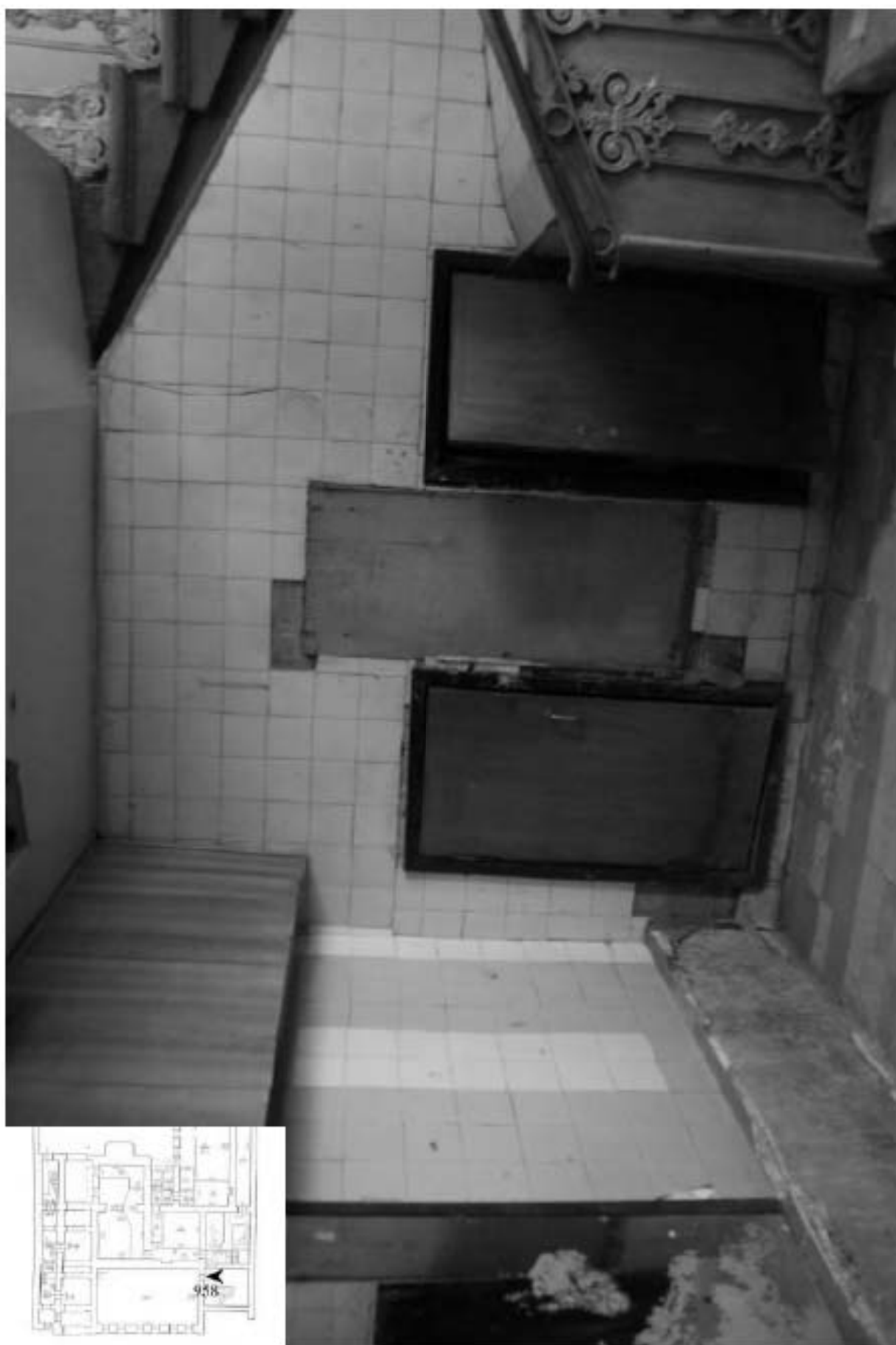
958. Лестничная площадка входа в подвал.
