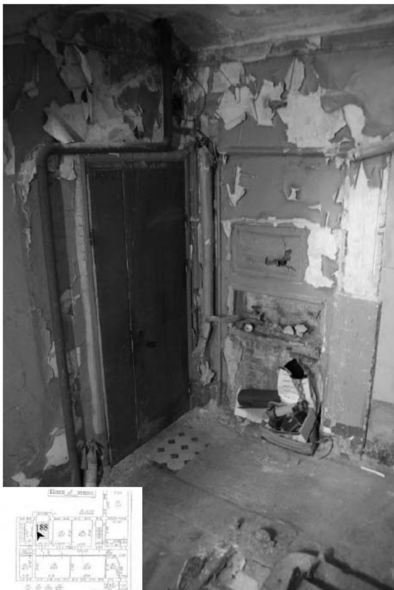
188. Лестница ЗЛК. Лестничная площадка 1 этажа.
