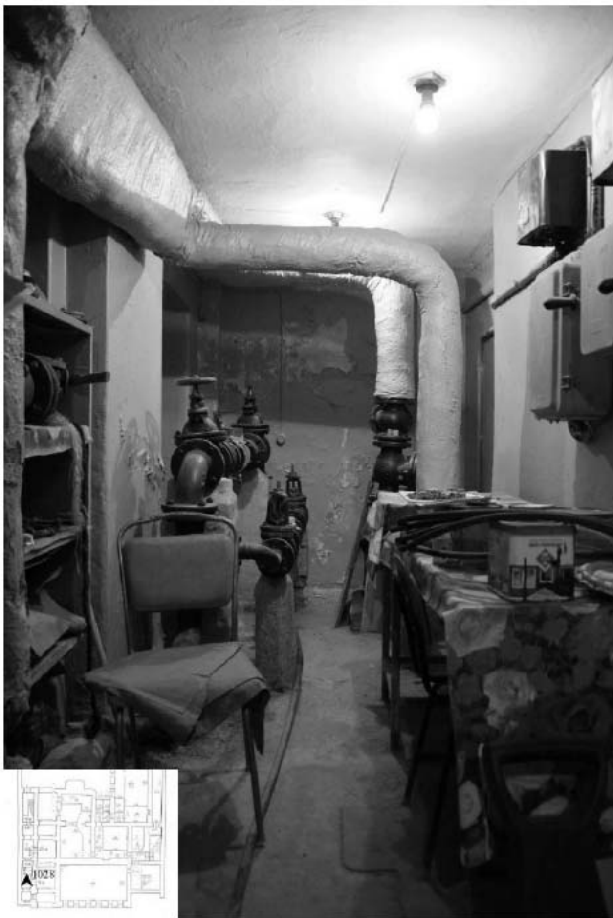
1028. Подвал, интерьер помещения 9-Н.
