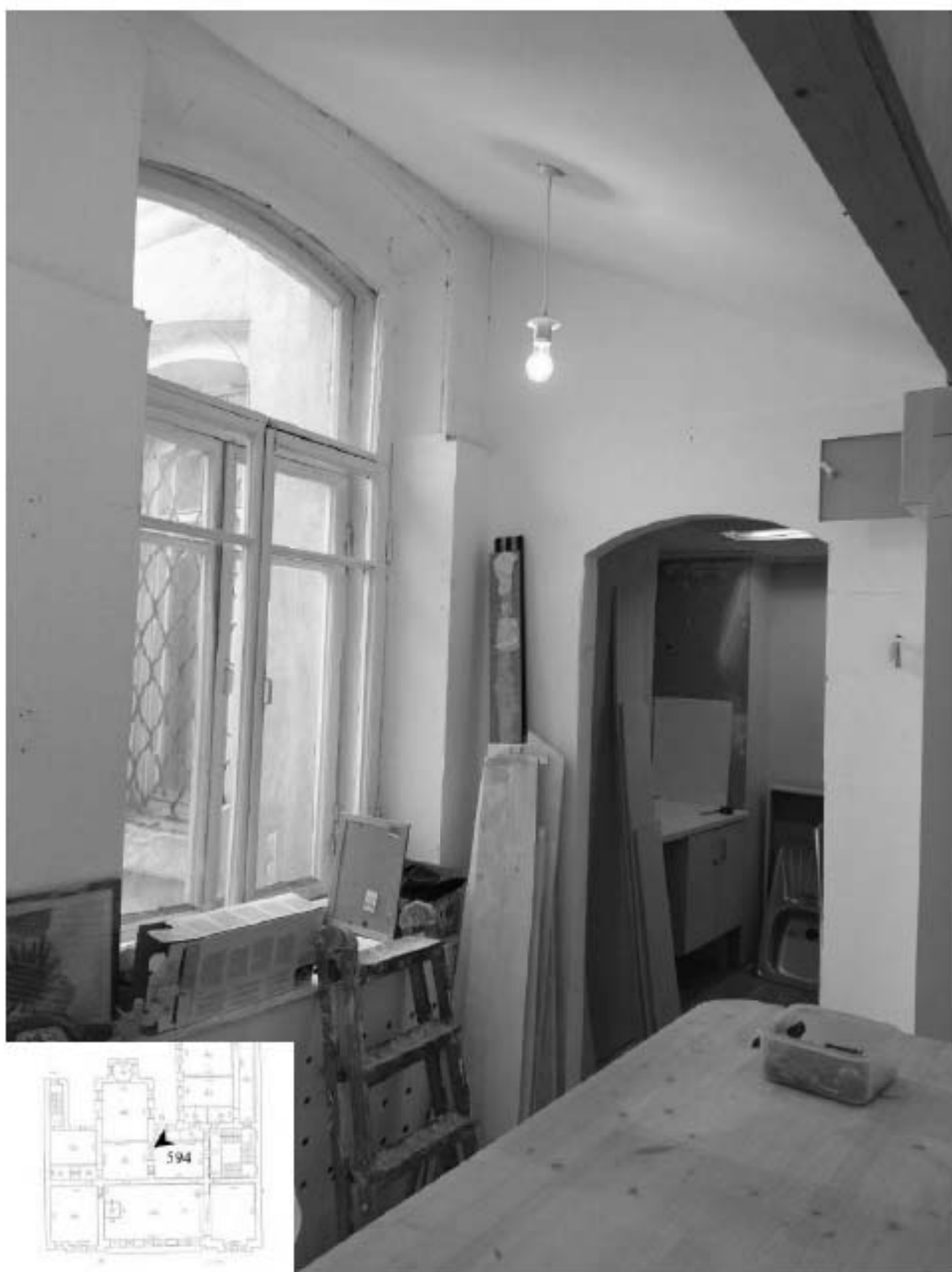
594. Этаж 3, помещение 37-Н. Интерьер комнаты 4,3 кв.м.
