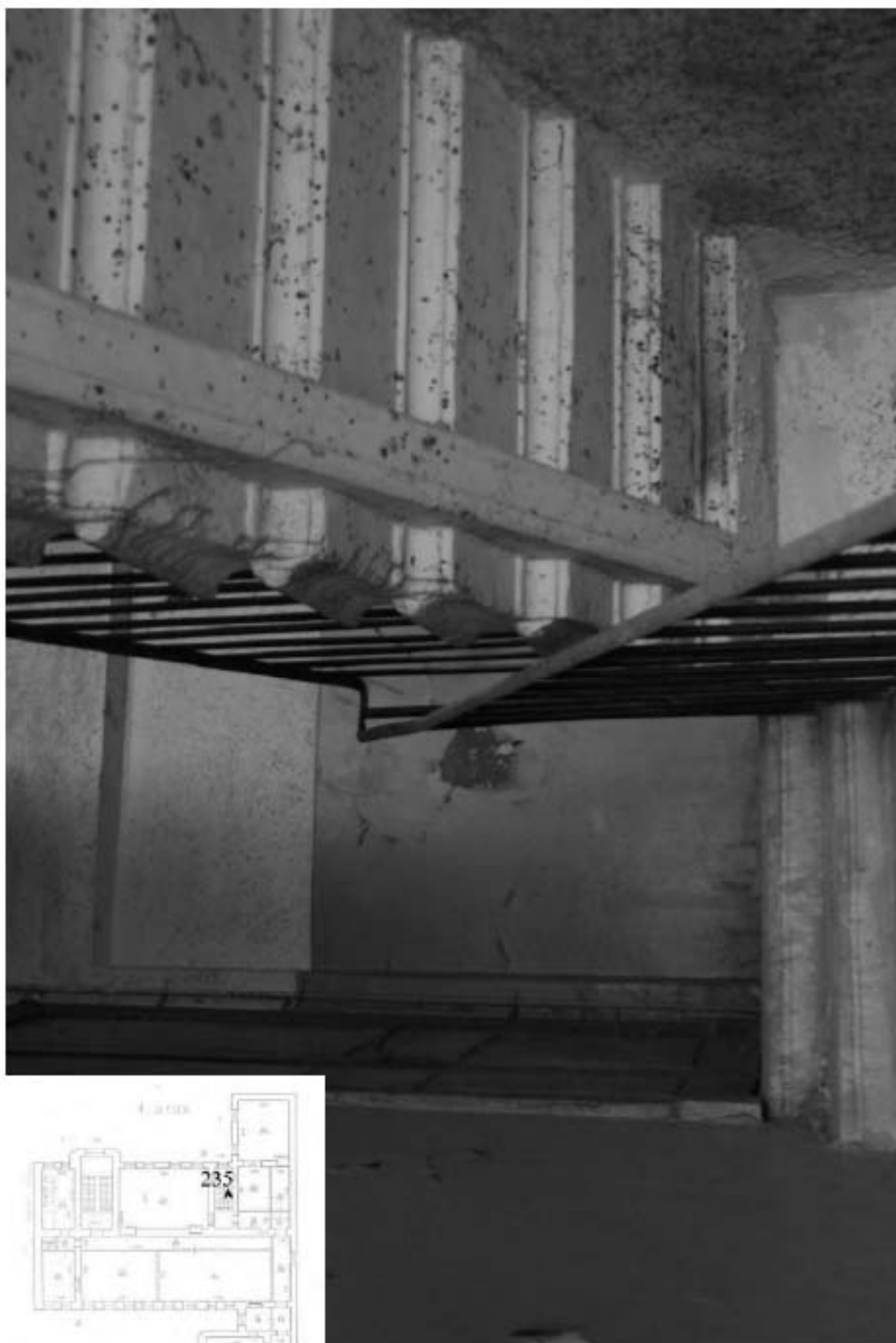
235. Лестница 4ЛК. Фрагмент.
