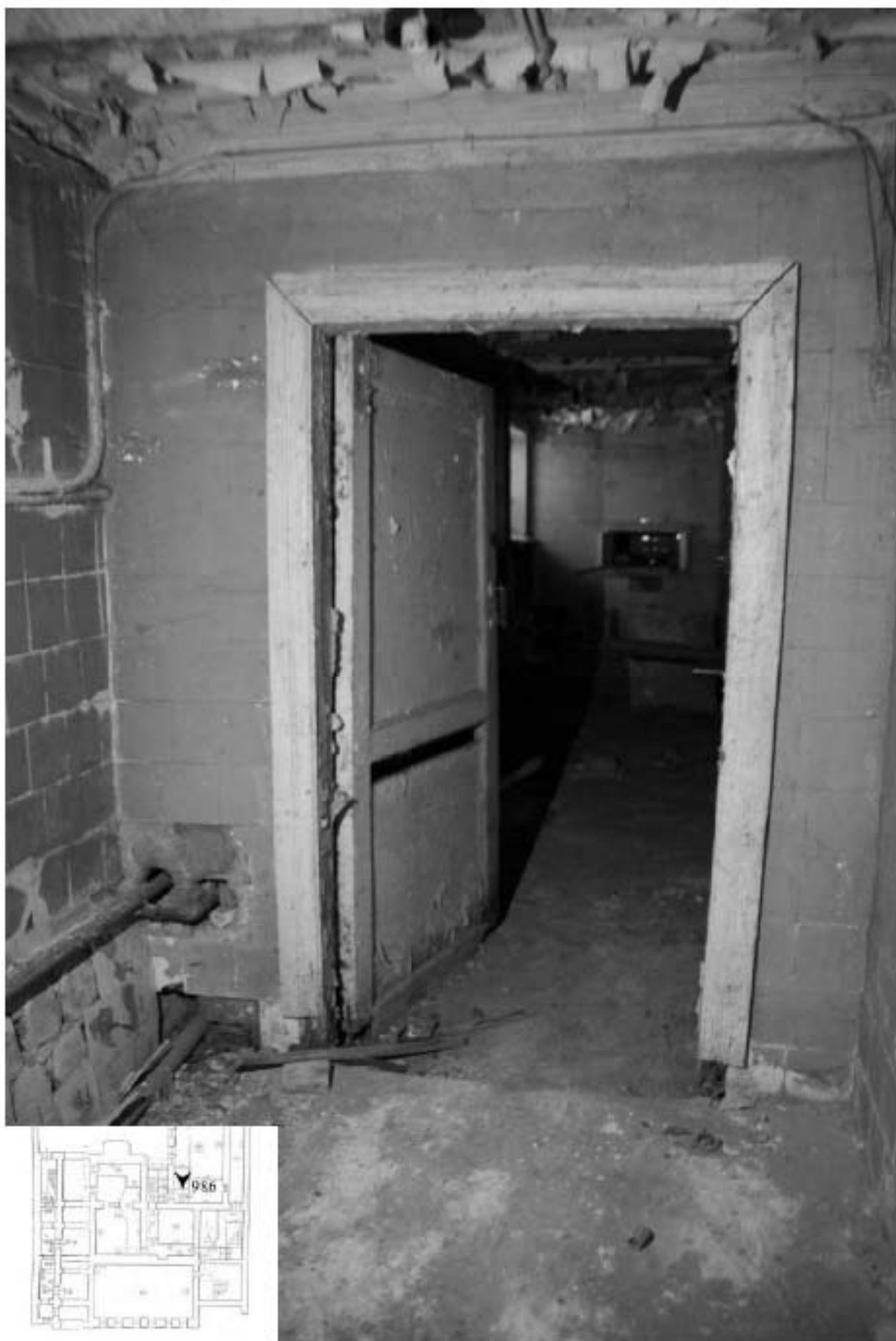
986. Подвал, помещение 6-Н. Вид в коридор из комнаты 4,7 кв.м.
