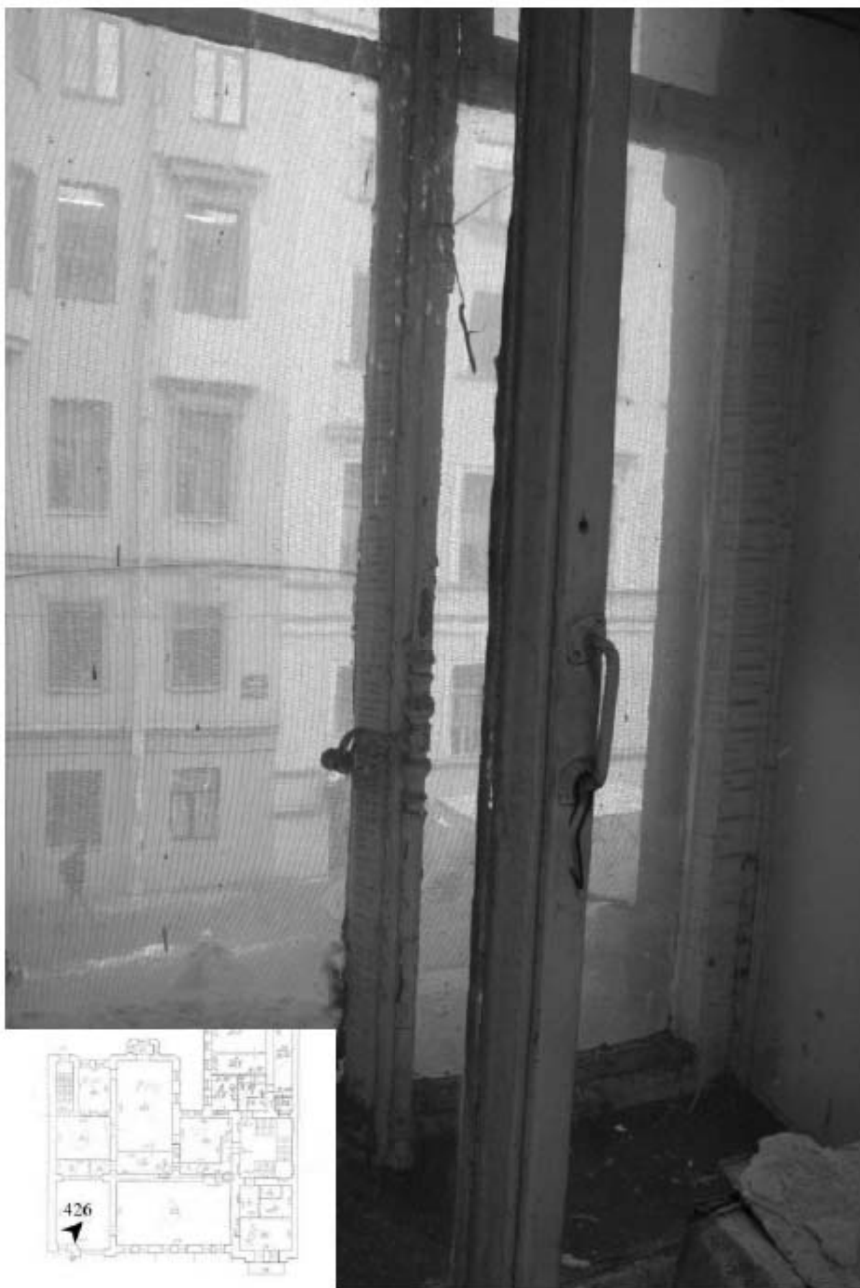
426. Этаж 2, помещение 26-Н. Интерьер комнаты 48,7 кв.м.
