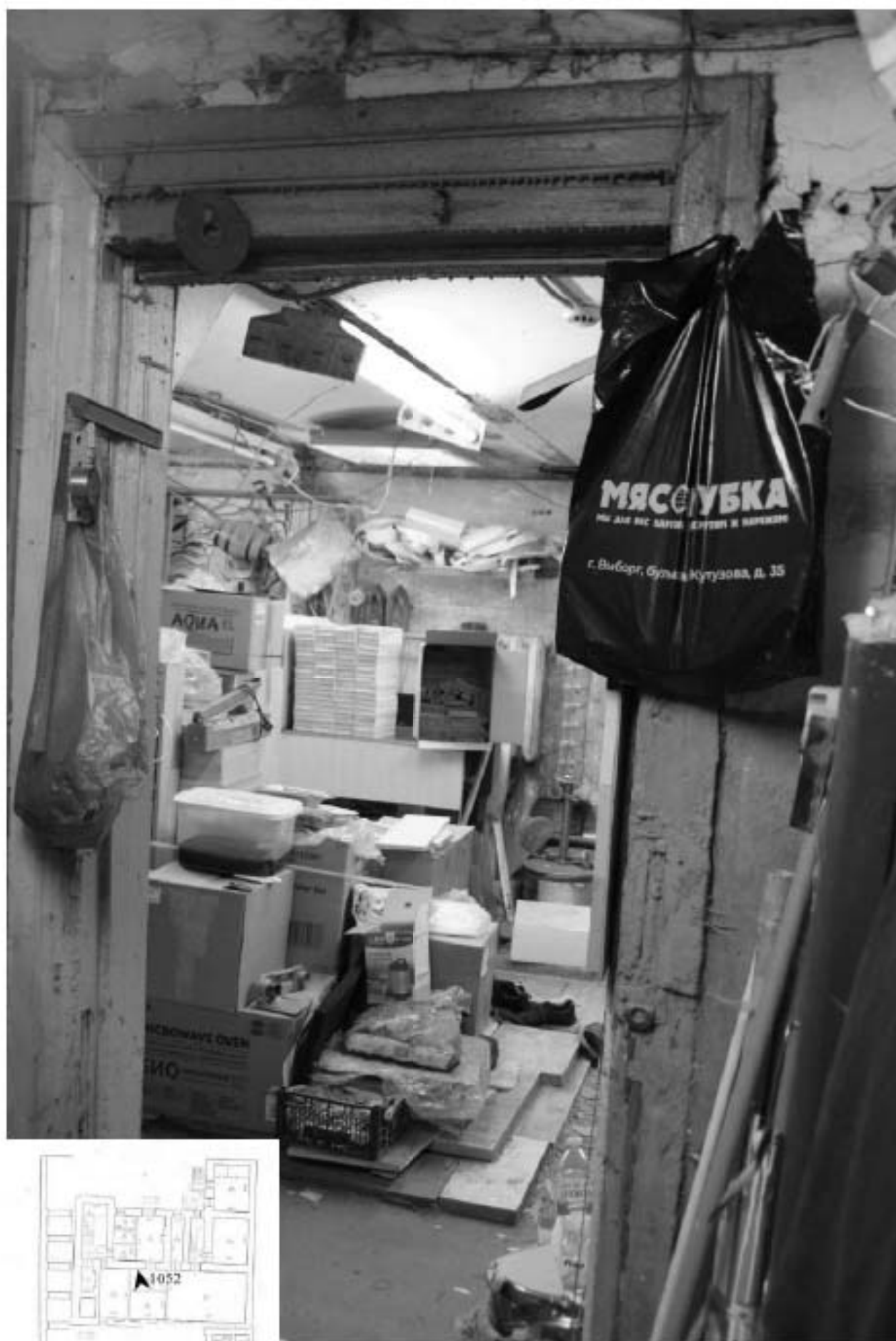
1052. Подвал, помещение 2-Н. Вход в комнату 18,4 кв.м.
