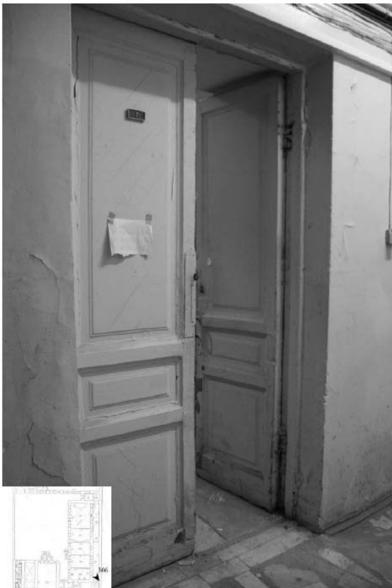
306. Этаж 1, помещение 15-Н. Дверь в комнату 24,8 кв.м.
