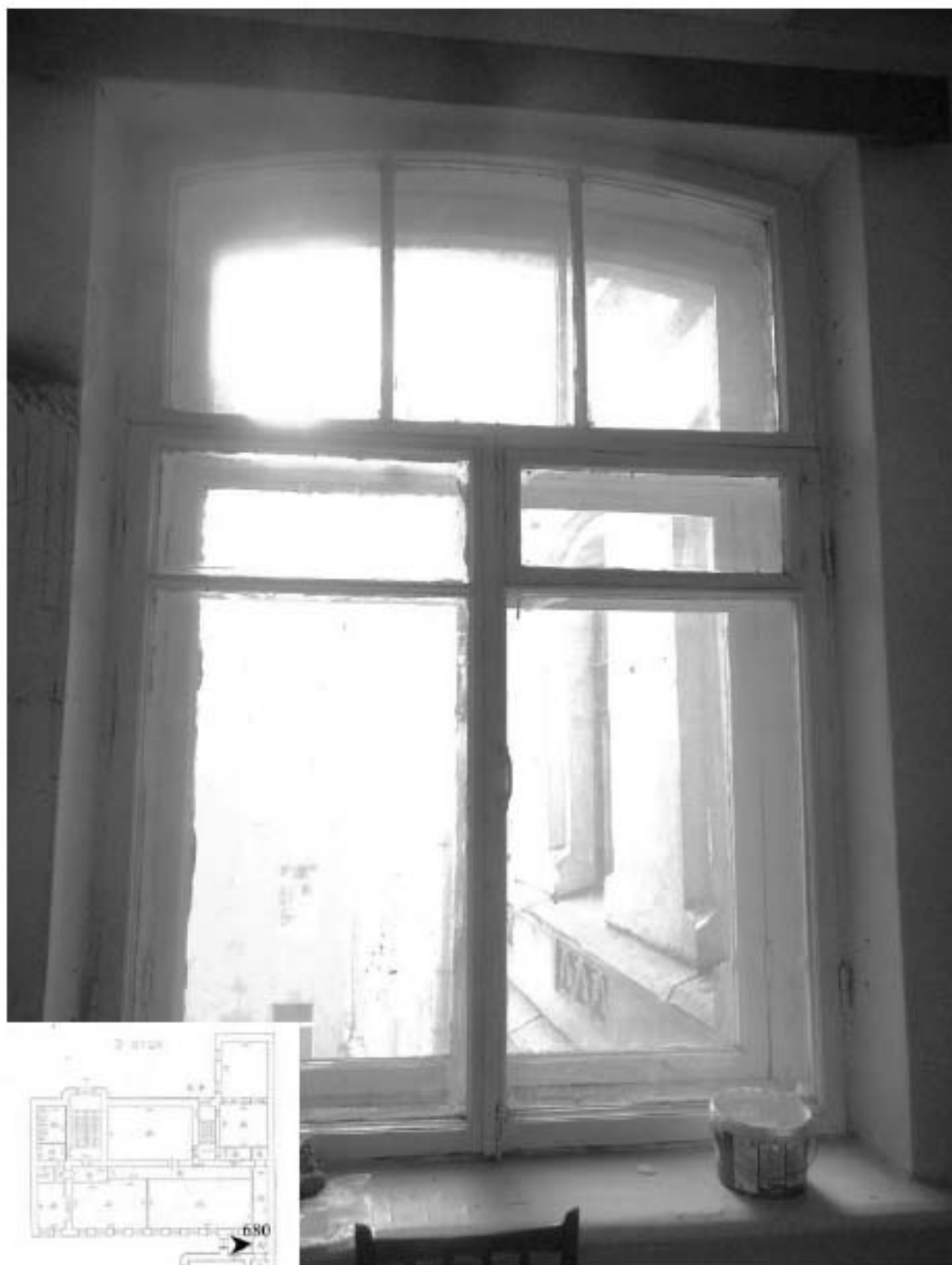
680. Этаж 3, помещение 17-Н. Интерьер комнаты 6,9 кв.м.
