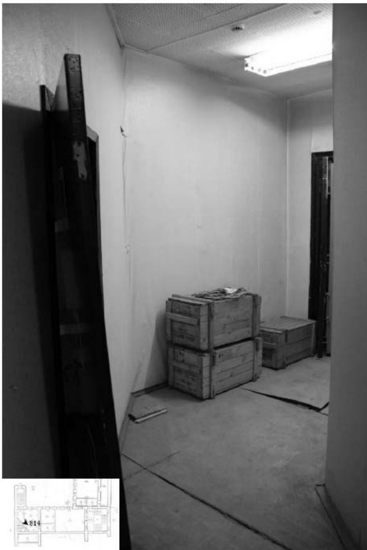
814. Этаж 5, помещение 31-Н. Интерьер комнаты 17,6 кв.м.
