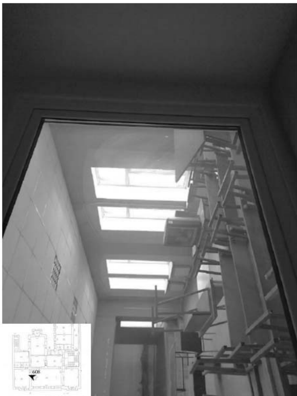
608. Этаж 3, помещение 37-Н. Вид из комнаты 3,5 кв.м.
