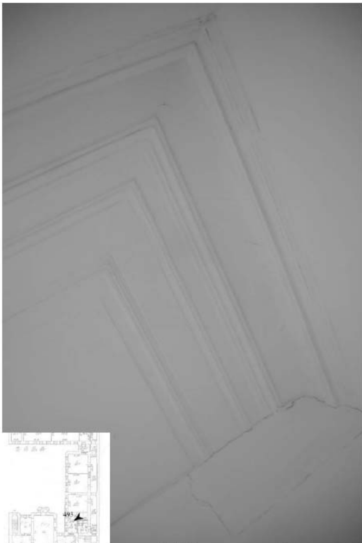
493. Этаж 2, помещение 16-Н. Интерьер комнаты 14,8 кв.м.
