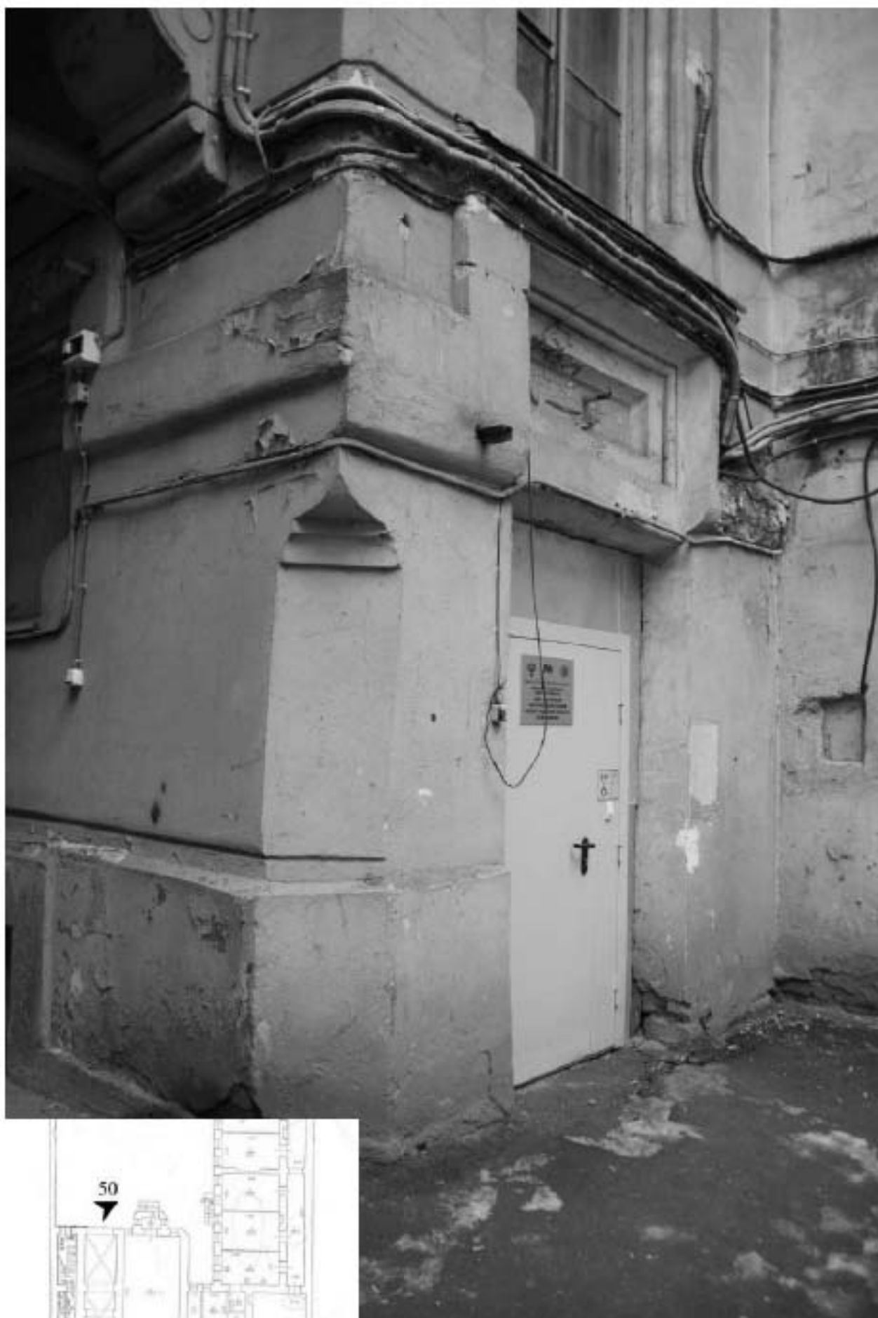
50. Фрагмент дворового фасада лицевого корпуса.
