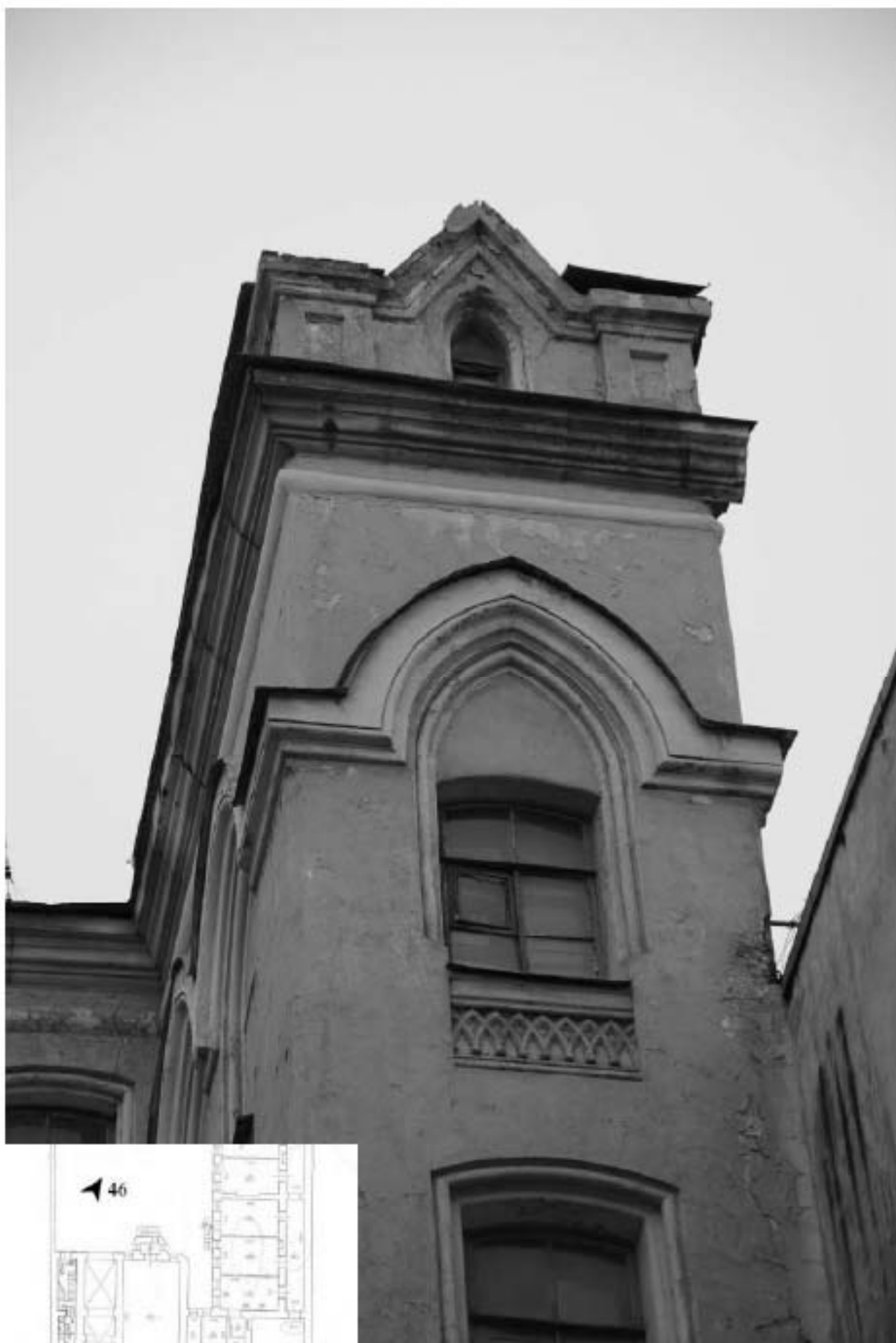
46. Фрагмент дворового фасада лицевого корпуса.
