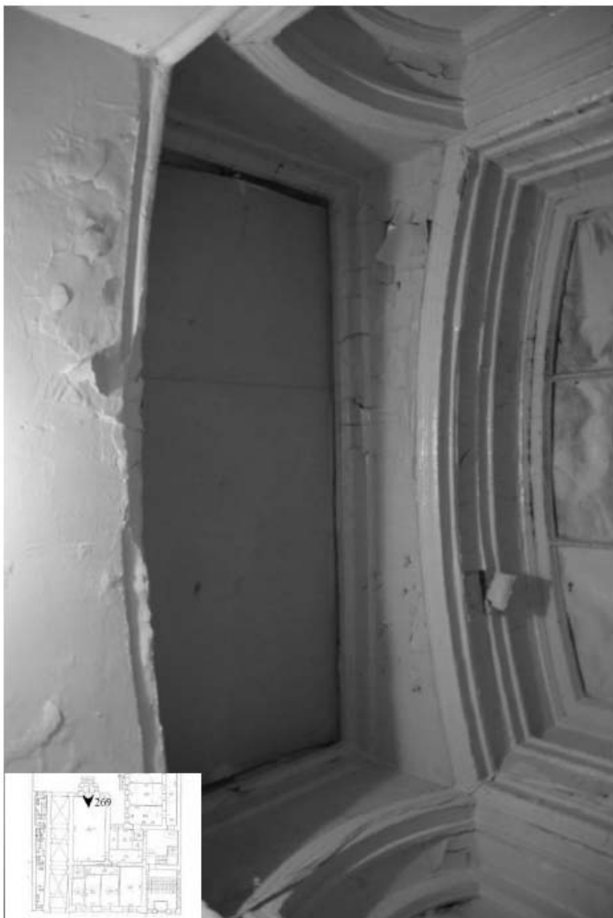
269. Этаж 1, помещение 20-Н. Интерьер входной группы.
