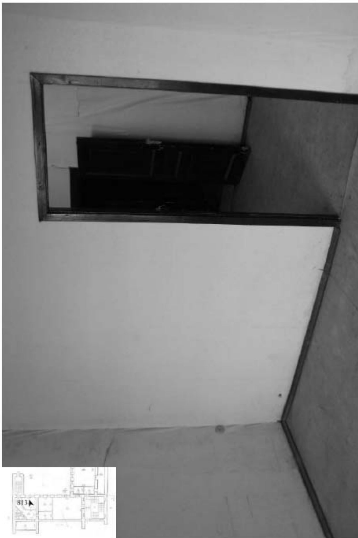
813. Этаж 5, помещение 31-Н. Интерьер комнаты 15,4 кв.м.
