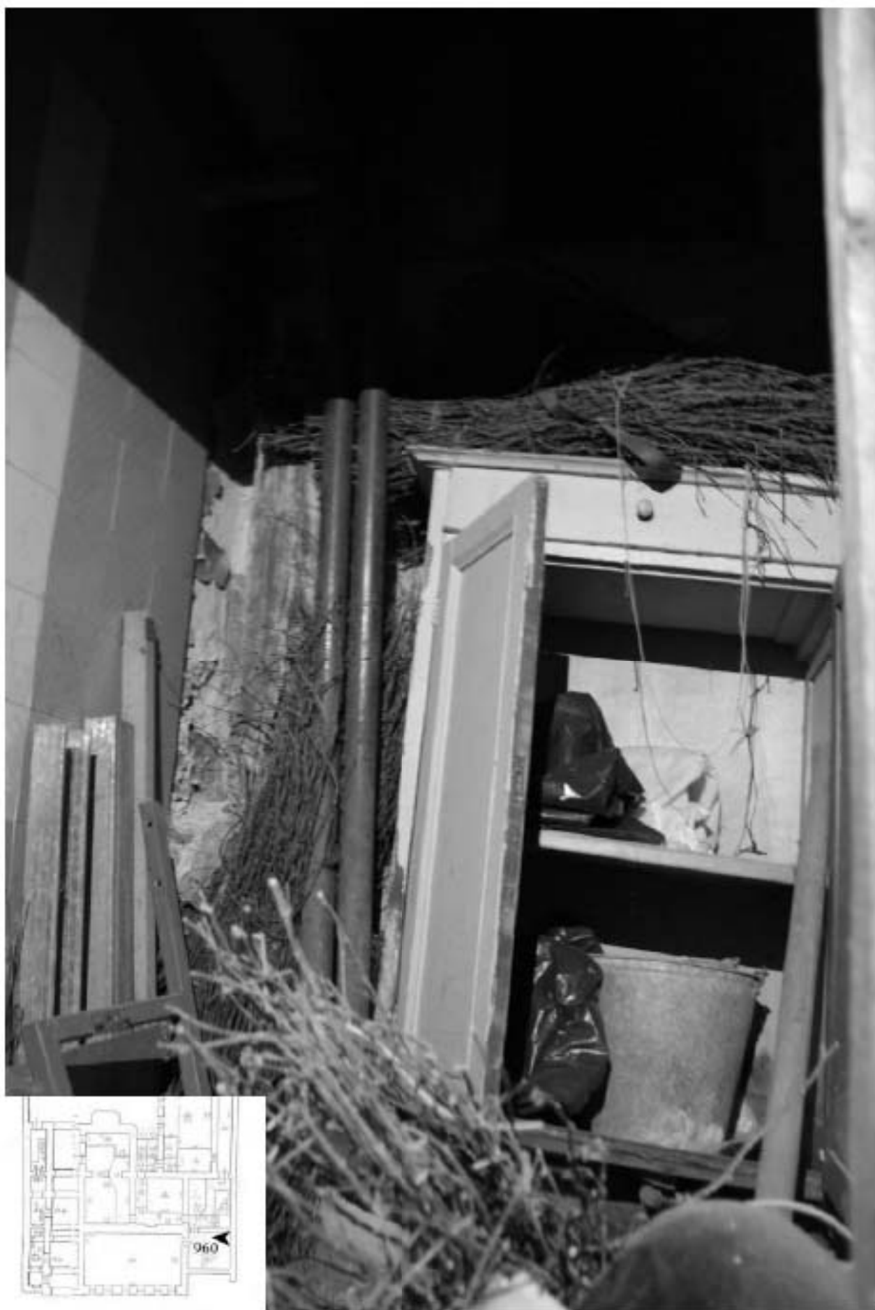
960. Подвал. Интерьер пространства под лестницей.
