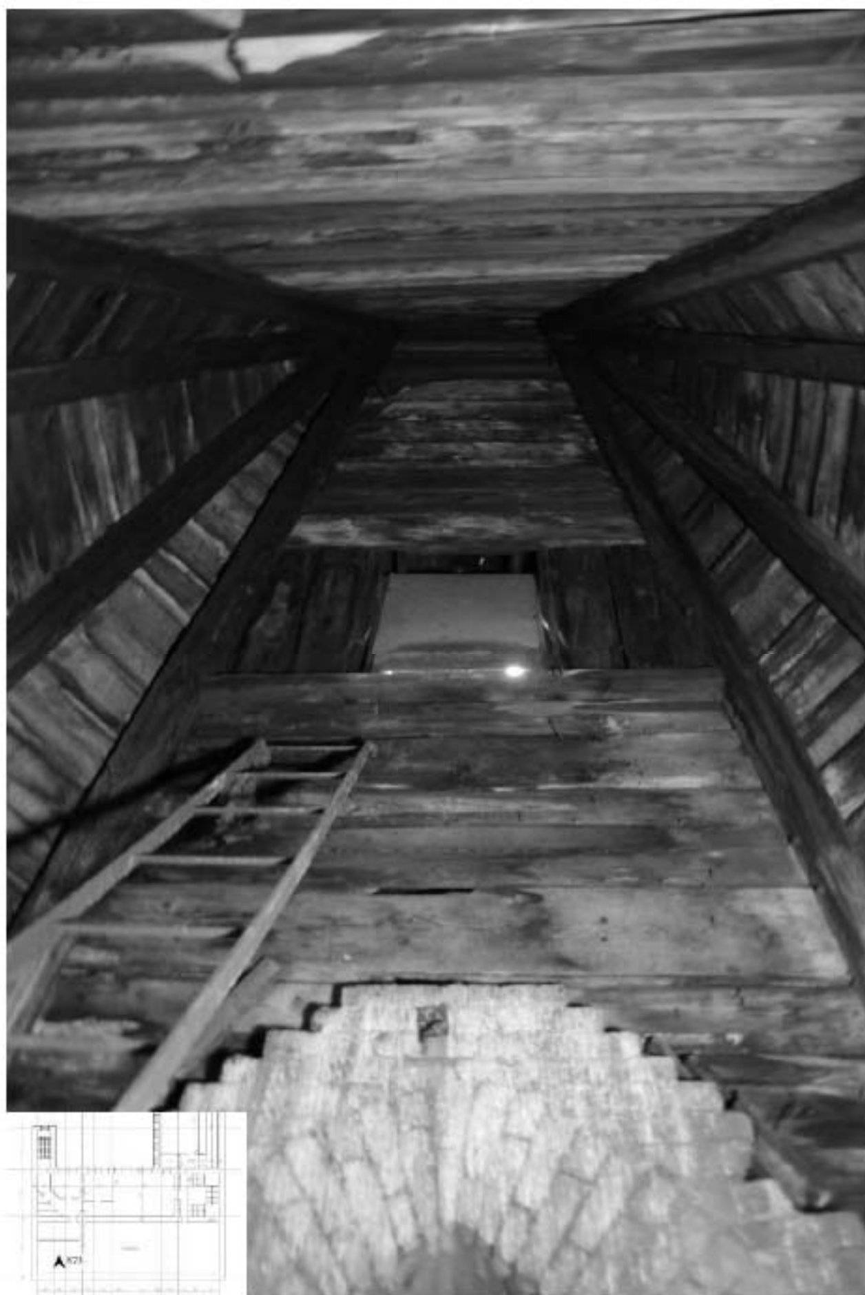
873. Этаж 5, интерьер чердака.
