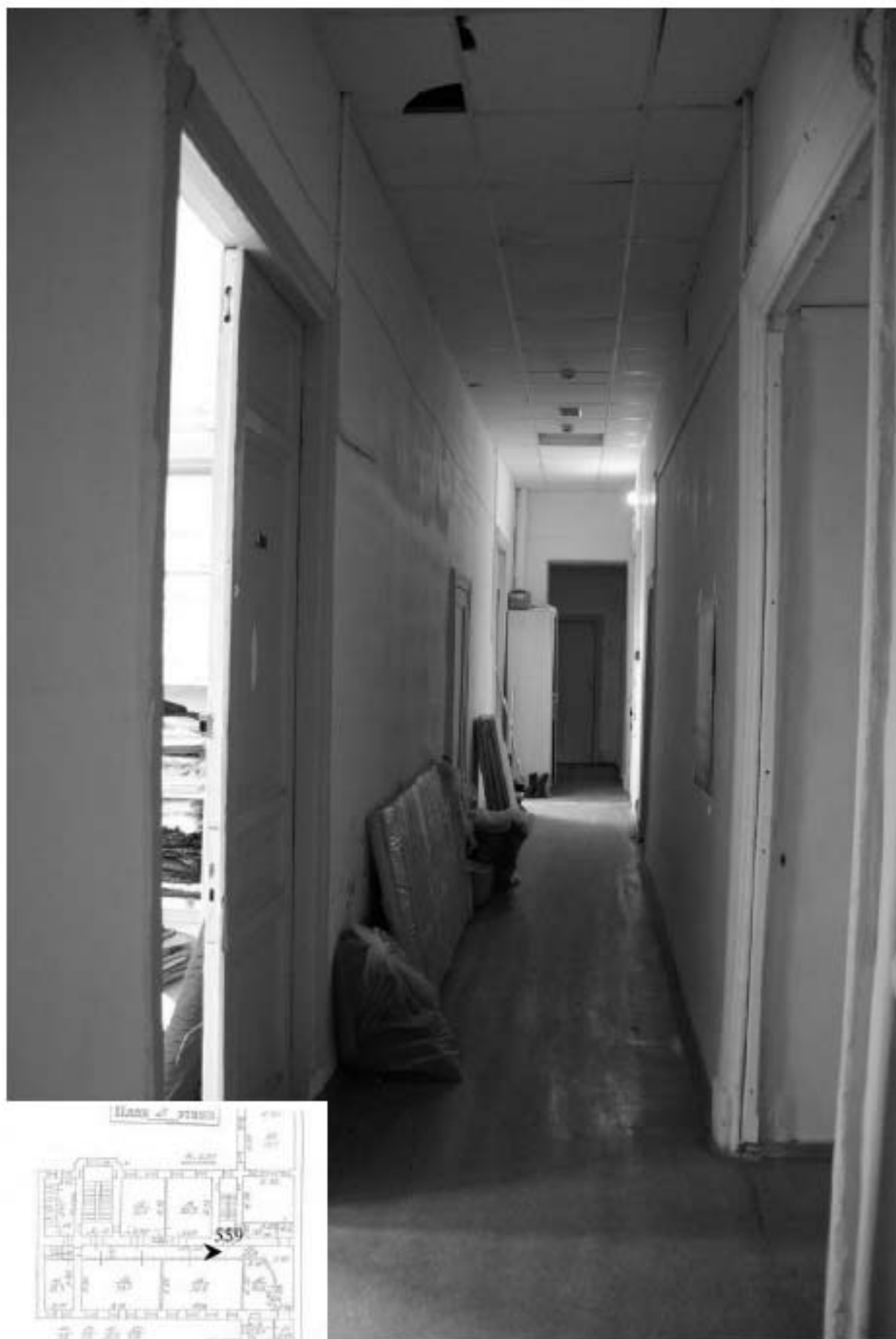
559. Этаж 2, помещение 16-Н. Вид коридора.
