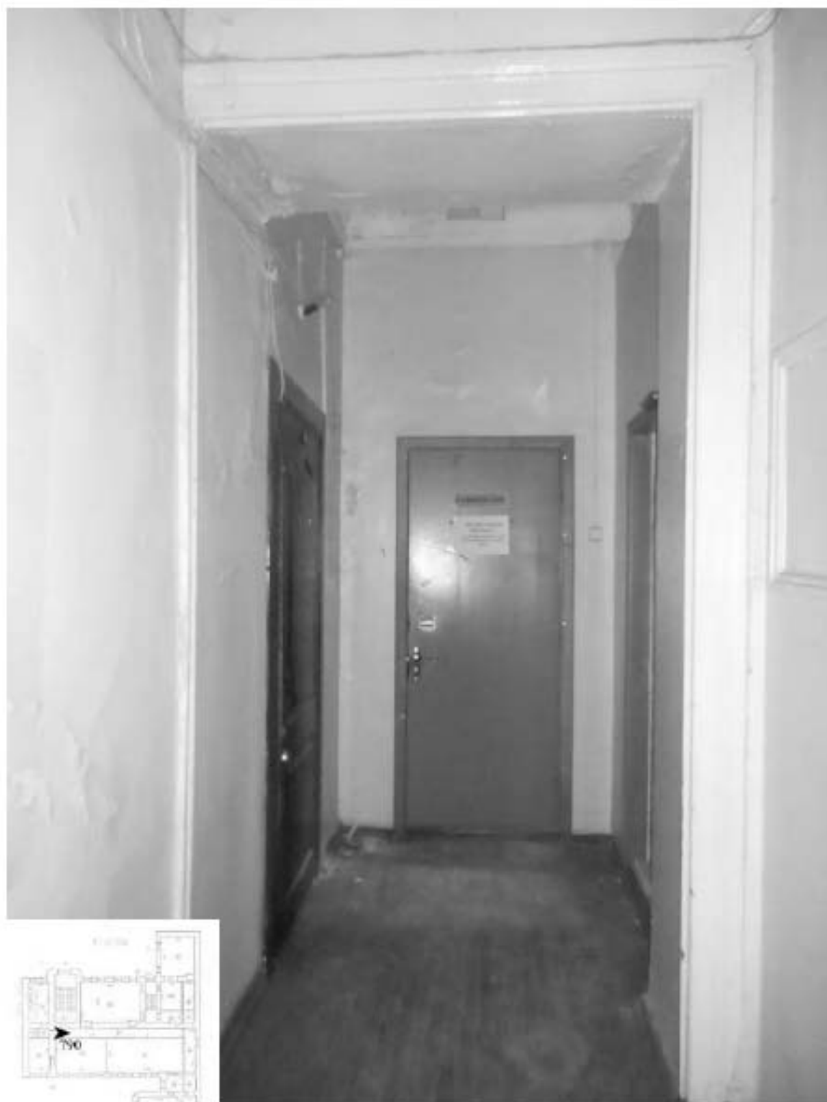
790. Этаж 4, помещение 40-Н. Вид коридора.
