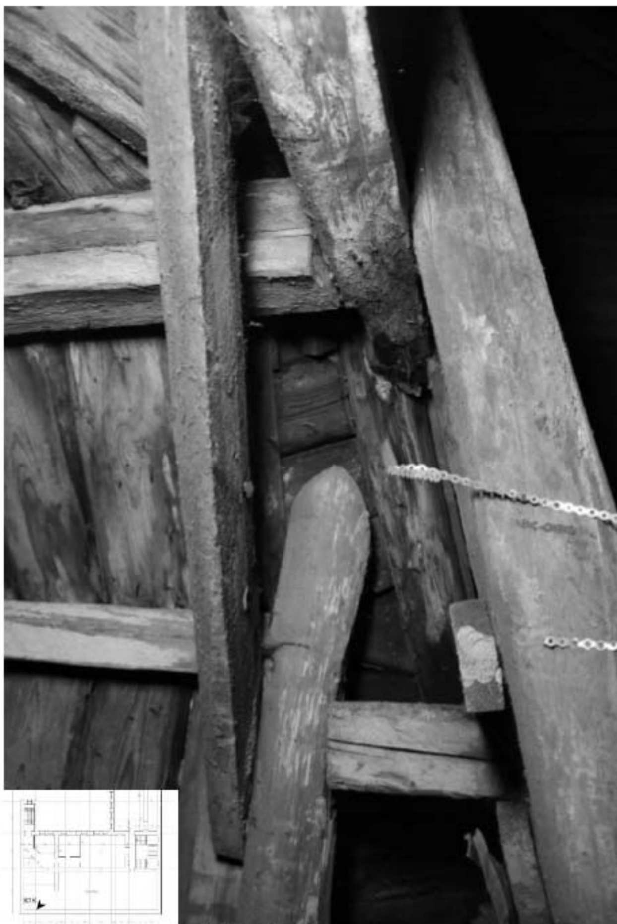
878. Этаж 5, интерьер чердака.
