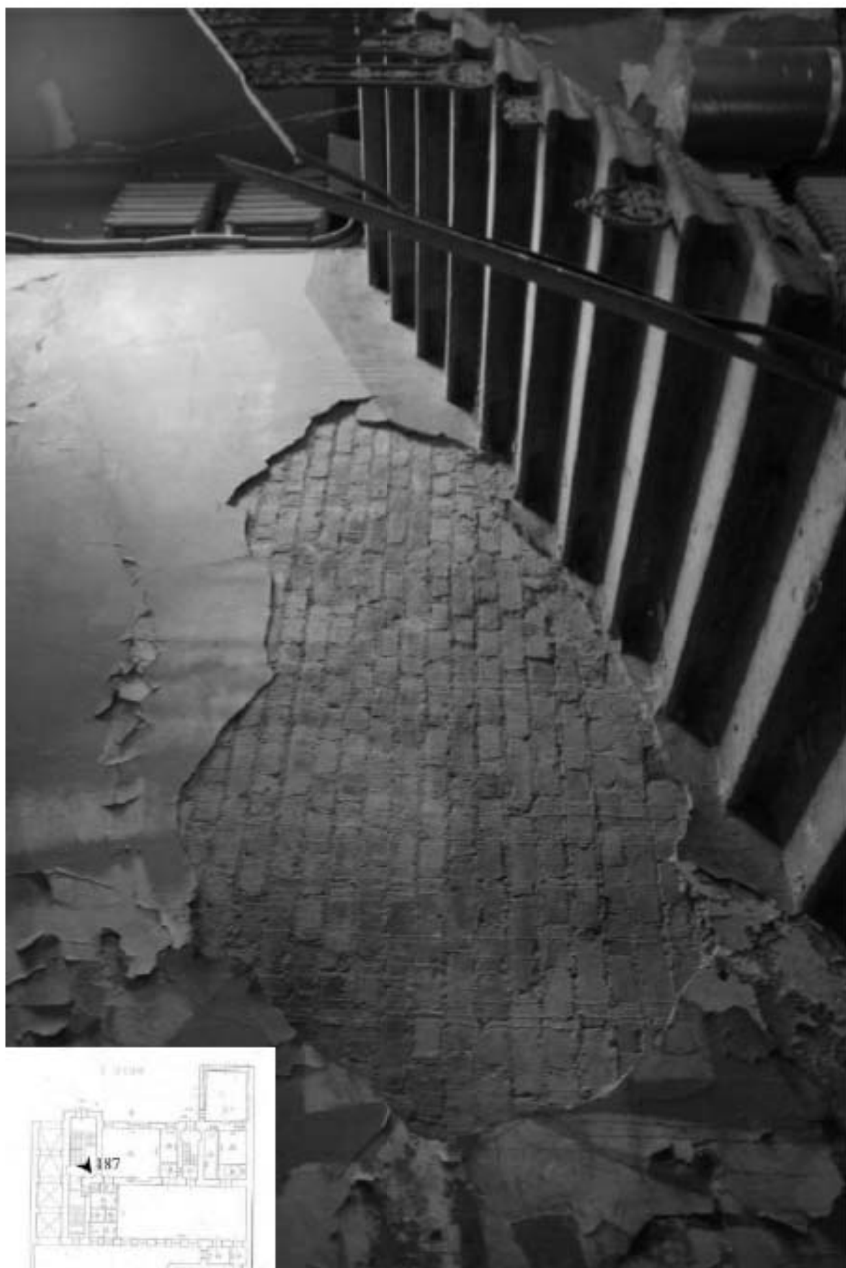
187. Лестница ЗЛК. Фрагмент.
