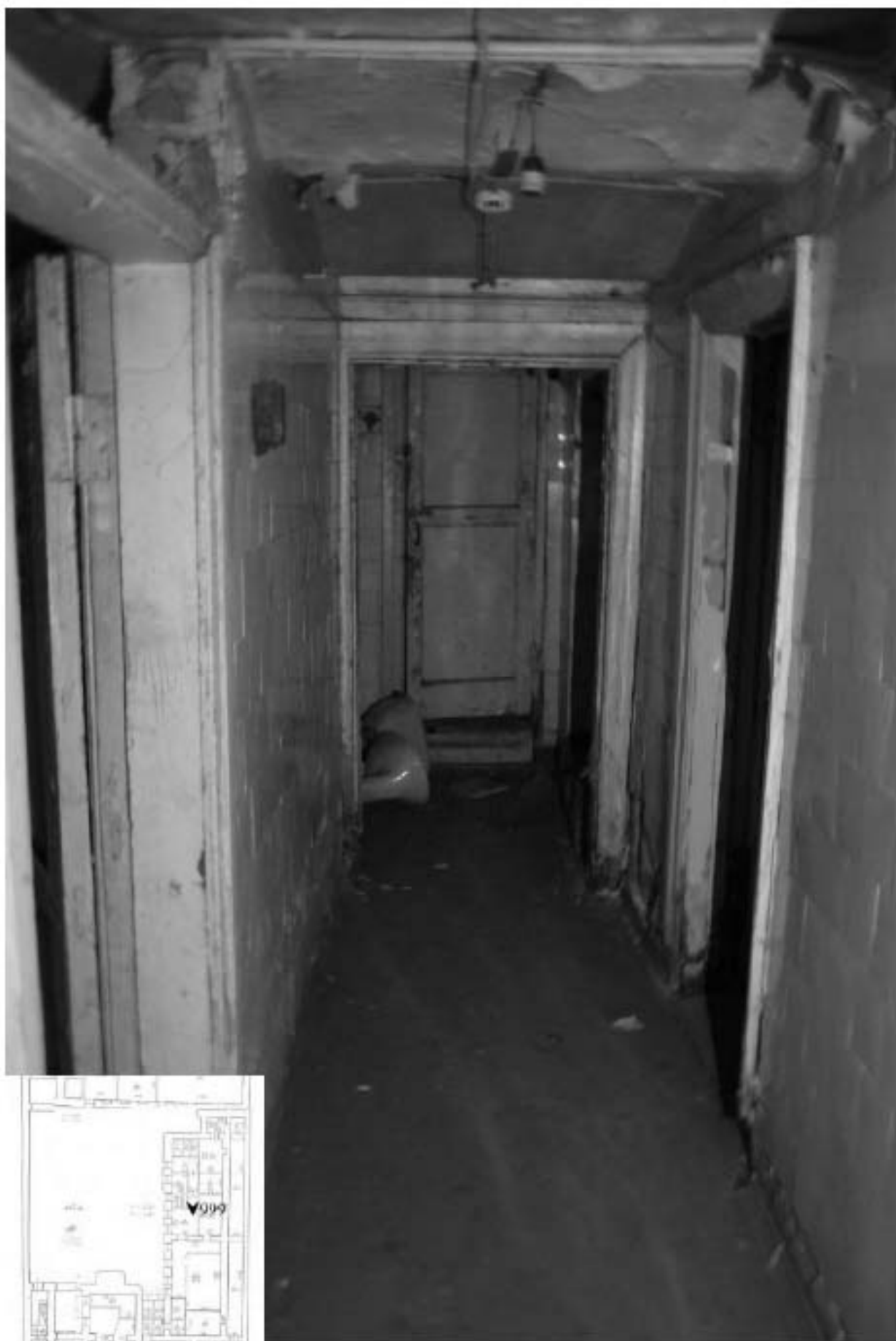
999. Подвал, помещение 6-Н. Вид коридора.
