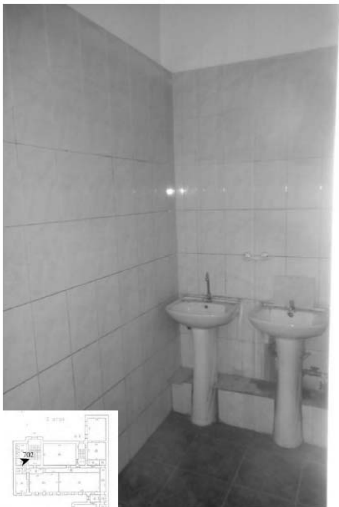
702. Этаж 3, помещение 17-Н. Интерьер комнаты 7,2 кв. м.
