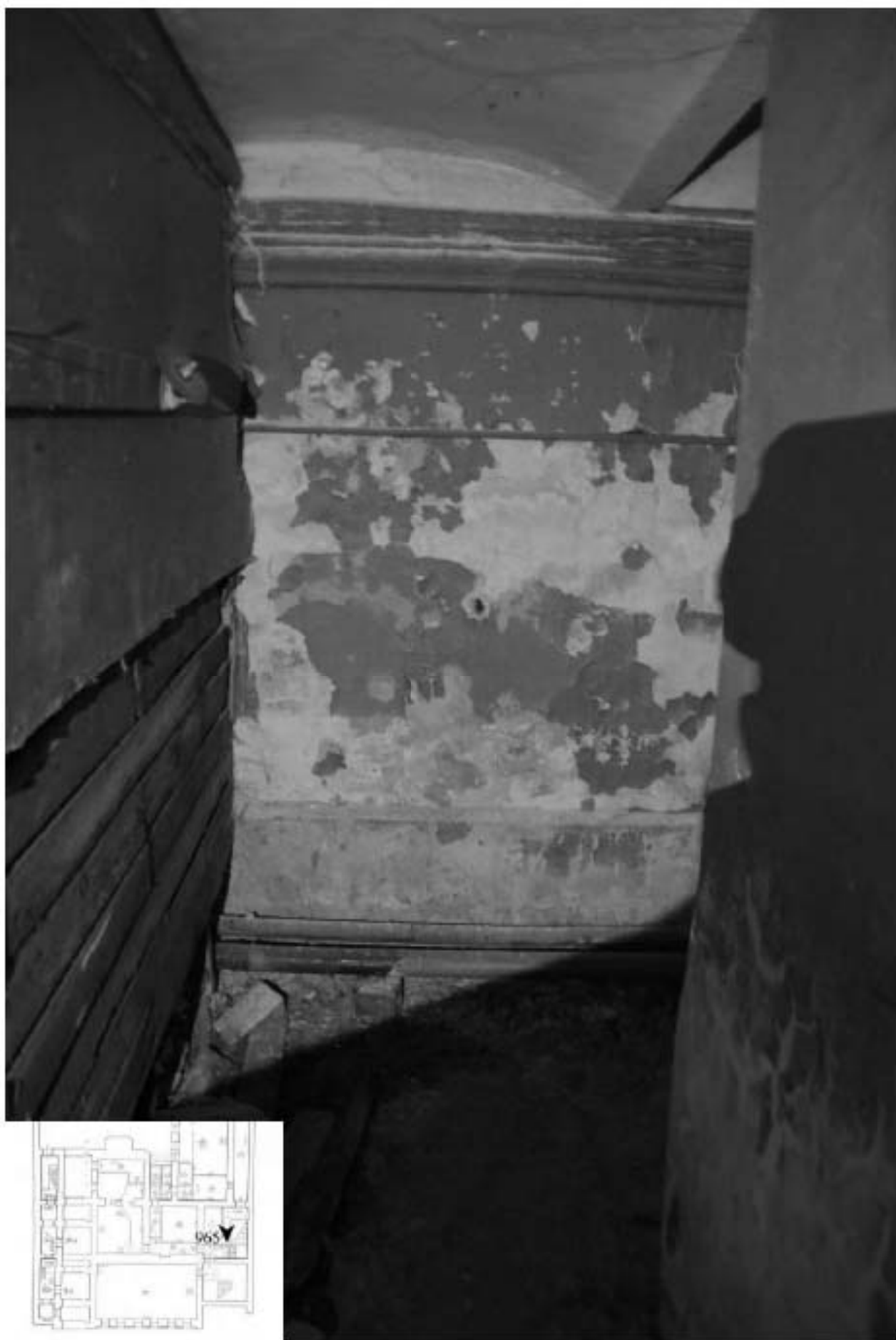
965. Подвал. Интерьер помещения 29-Н.
