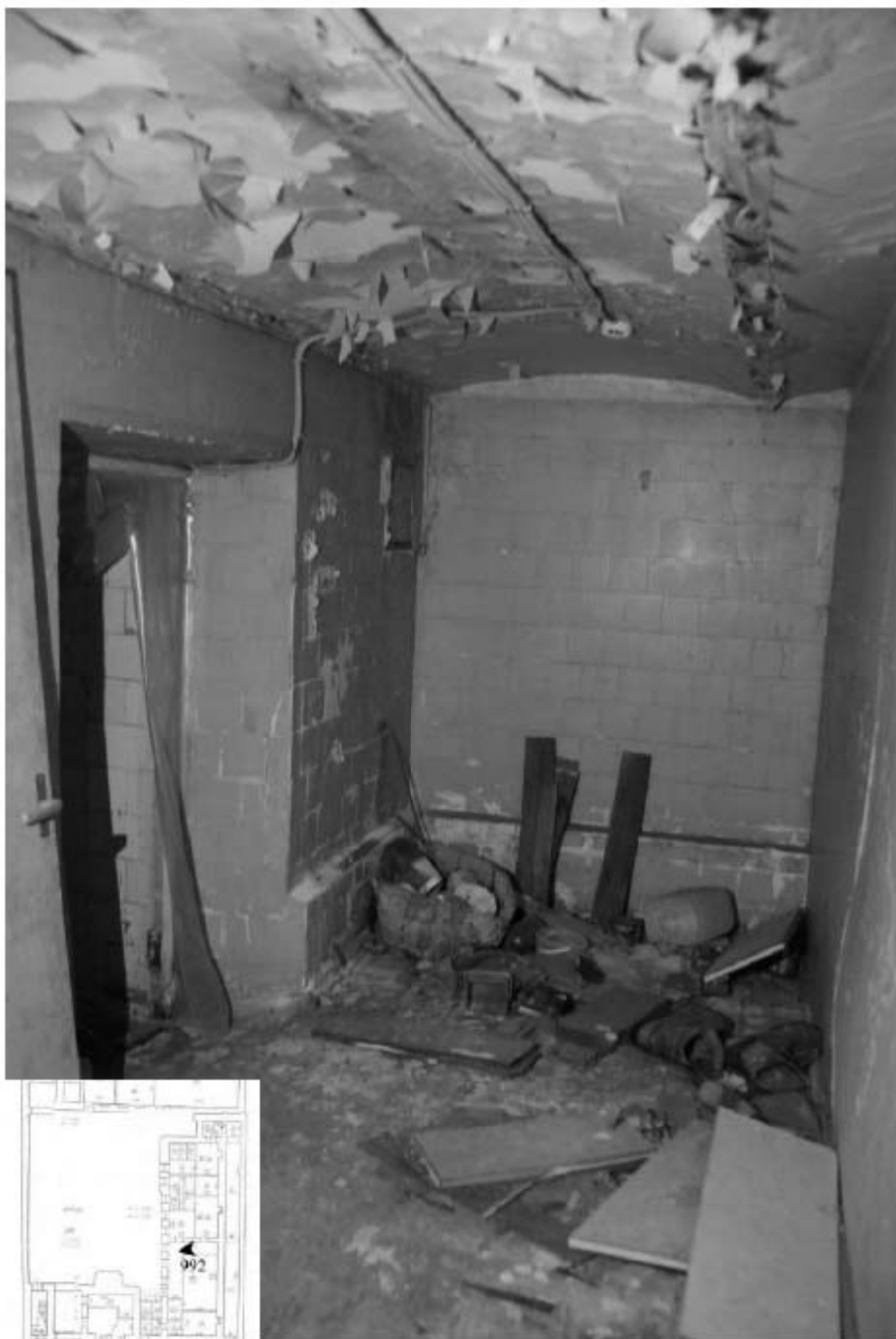
992. Подвал, помещение 6-Н. Вид коридора.
