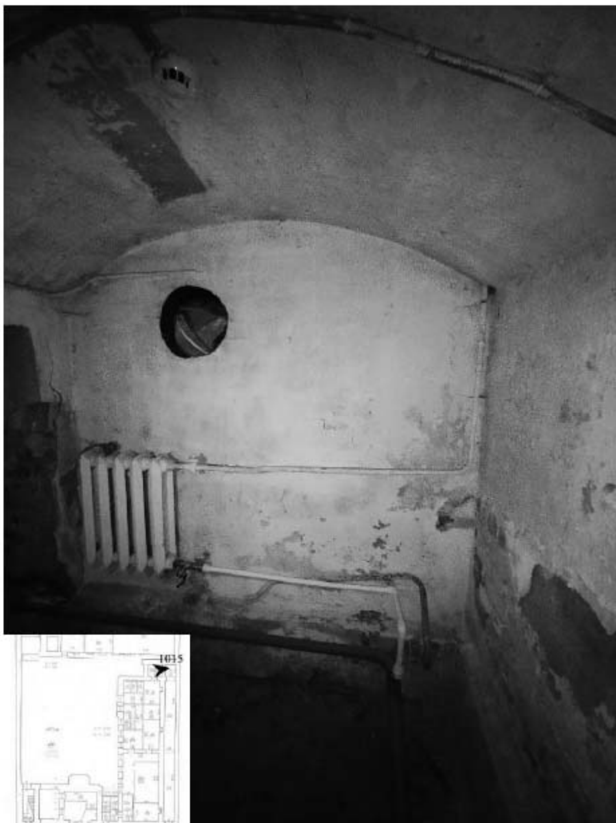
1015. Подвал, помещение 6-Н. Интерьер комнаты 4,3 кв.м.
