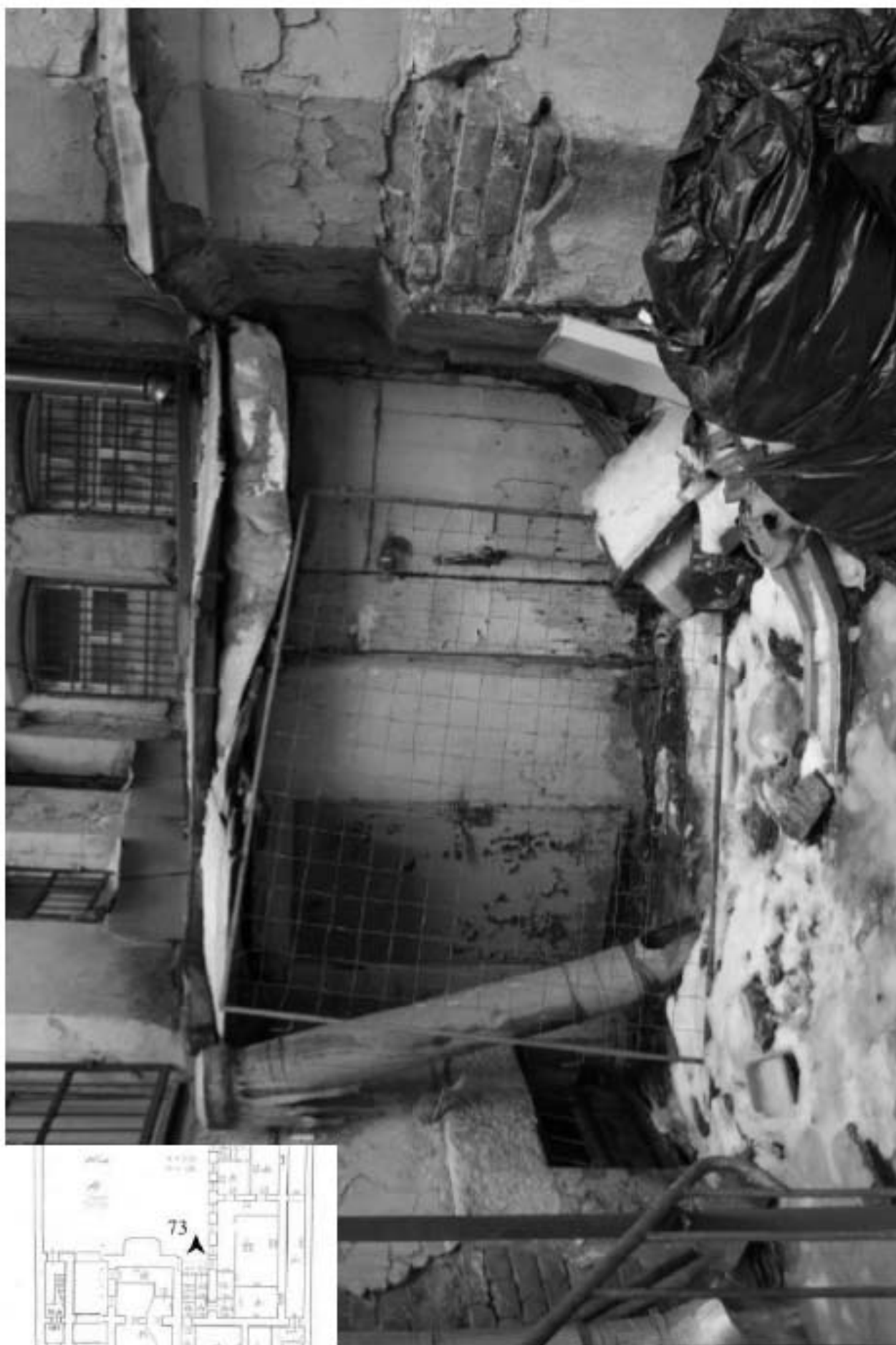
73. Фрагмент дворового фасада лицевого корпуса.
