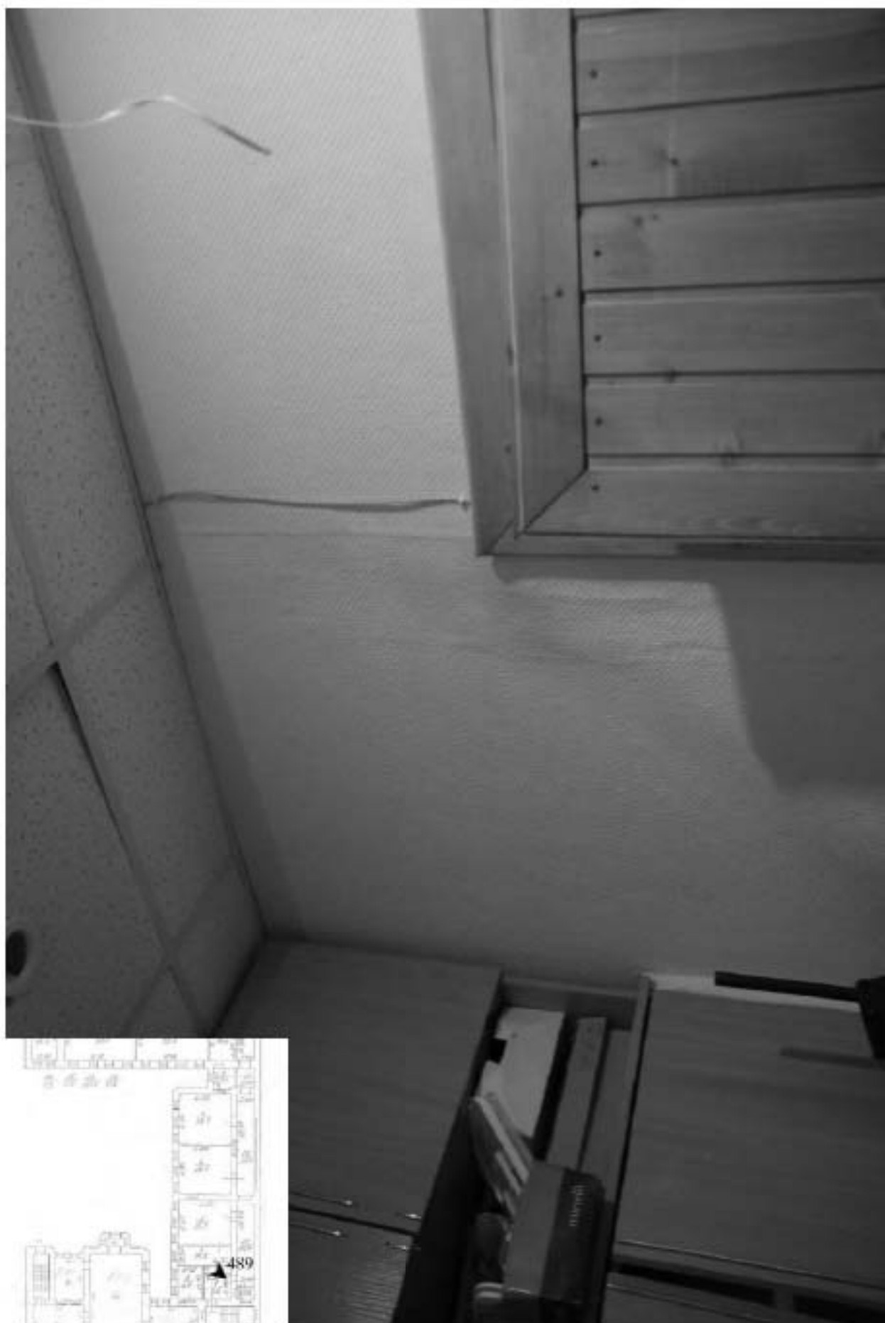
489. Этаж 2, помещение 16-Н. Проход в комнату 14,8 кв.м.
