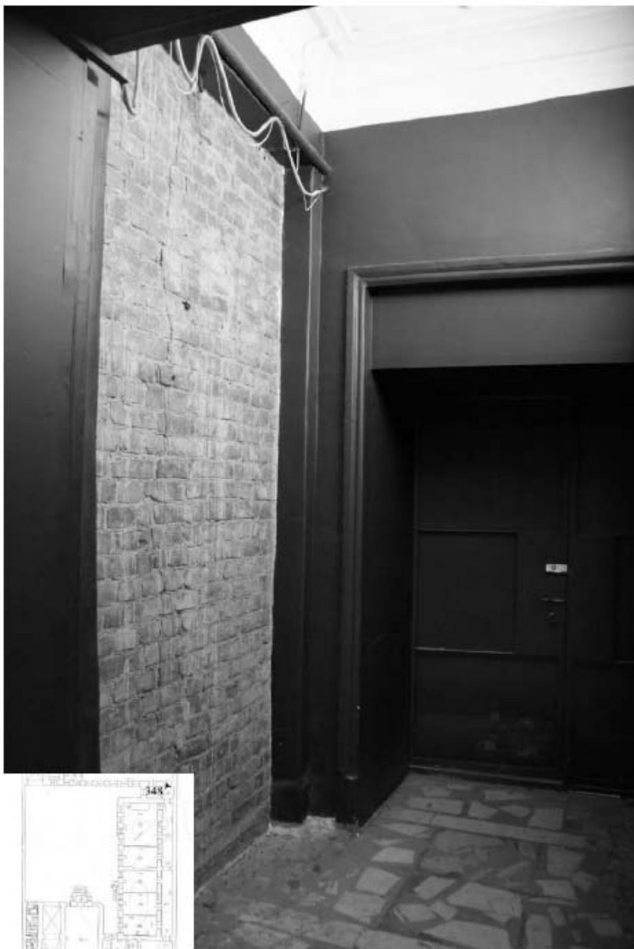
348. Этаж 1, помещение 15-Н. Интерьер комнаты 3,7 кв.м.
