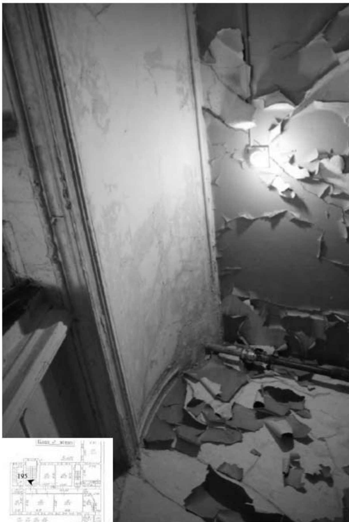
195. Лестница 3ЛК. Своды лестничной площадки 2 этажа.
