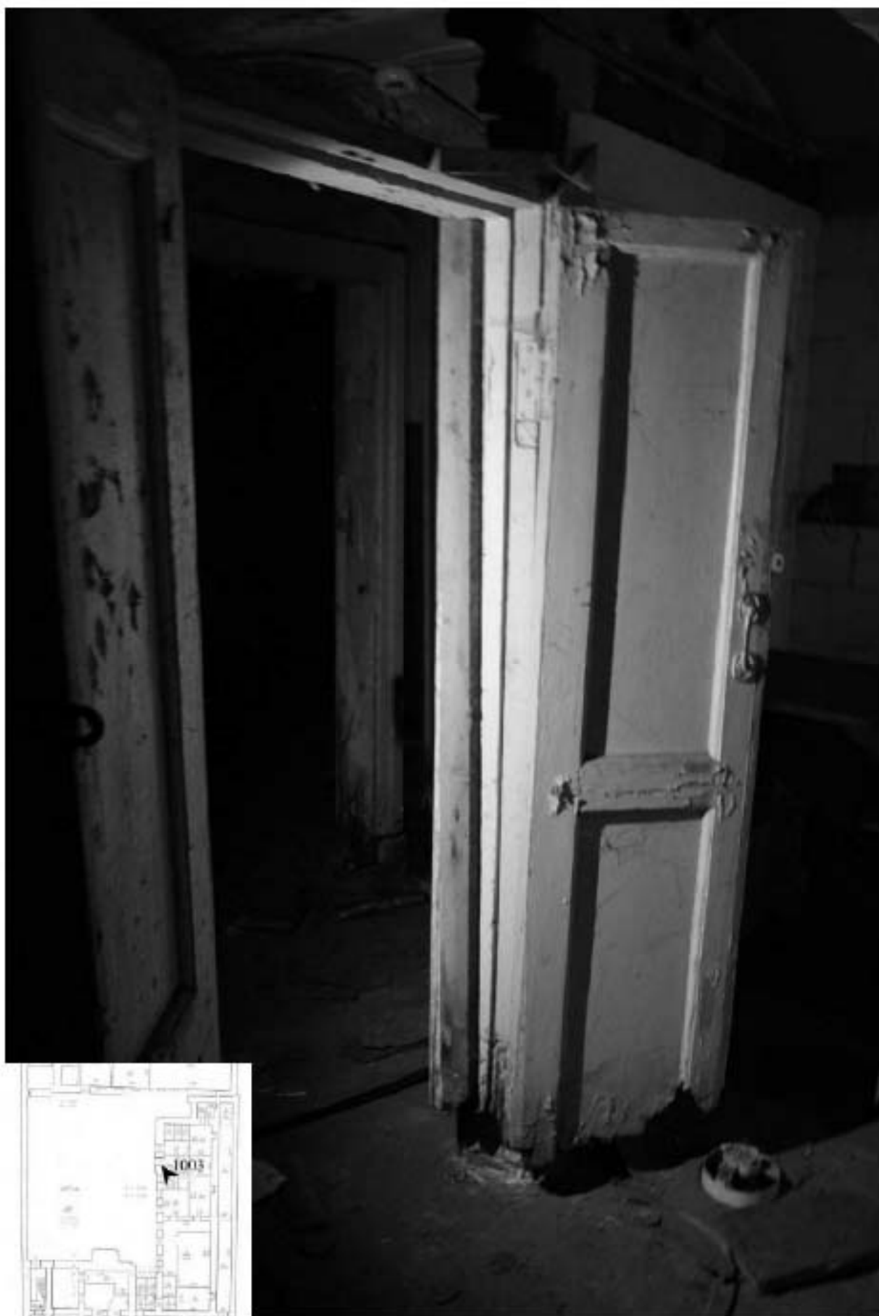
1003. Подвал, помещение 6-Н. Двери комнаты 9,4 кв.м.
