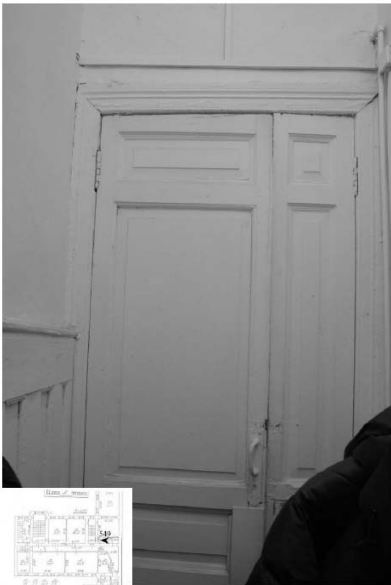
549. Этаж 2, помещение 16-Н. Дверь комнаты 22.
