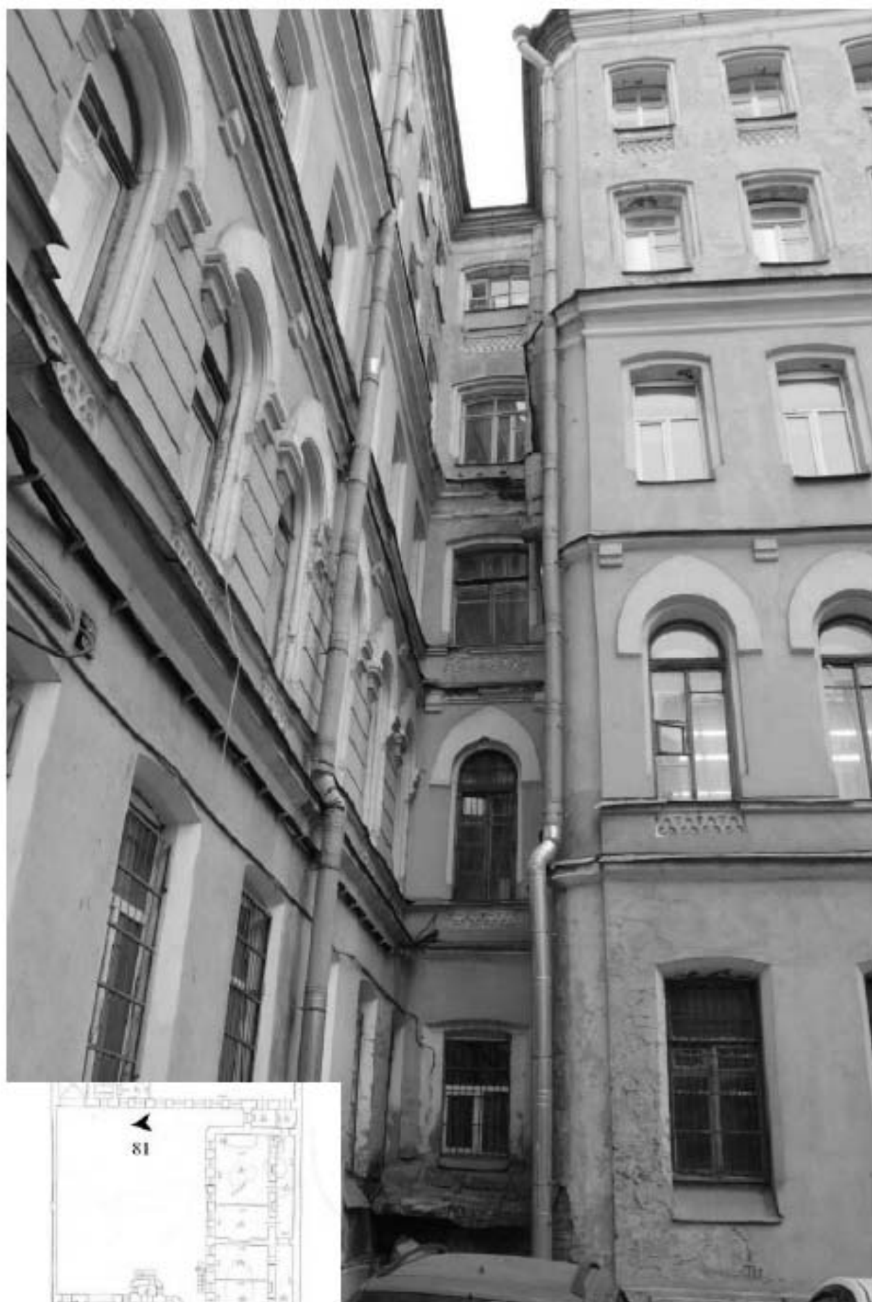
81. Фрагмент дворового фасада.
