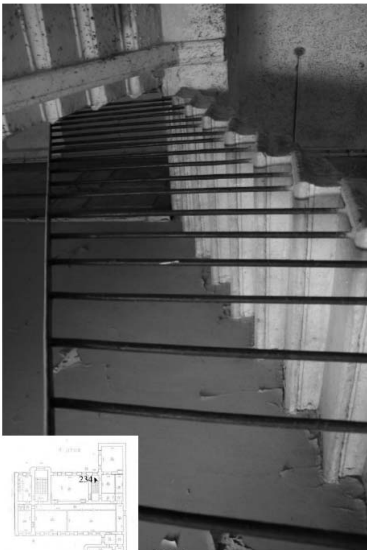
234. Лестница 4ЛК. Ограждение лестницы.
