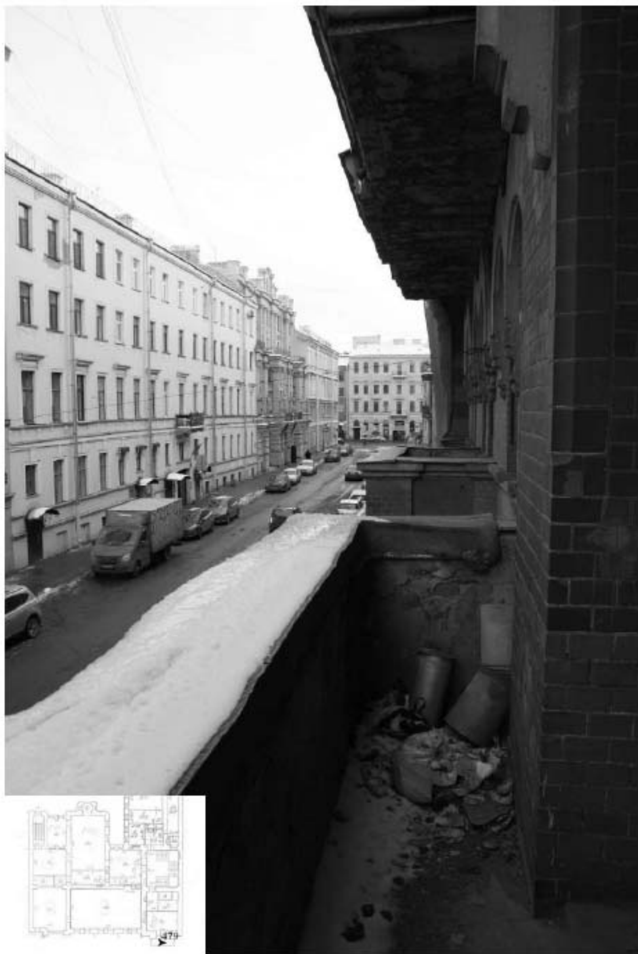
479. Этаж 2, помещение 30-Н. Балкон.
