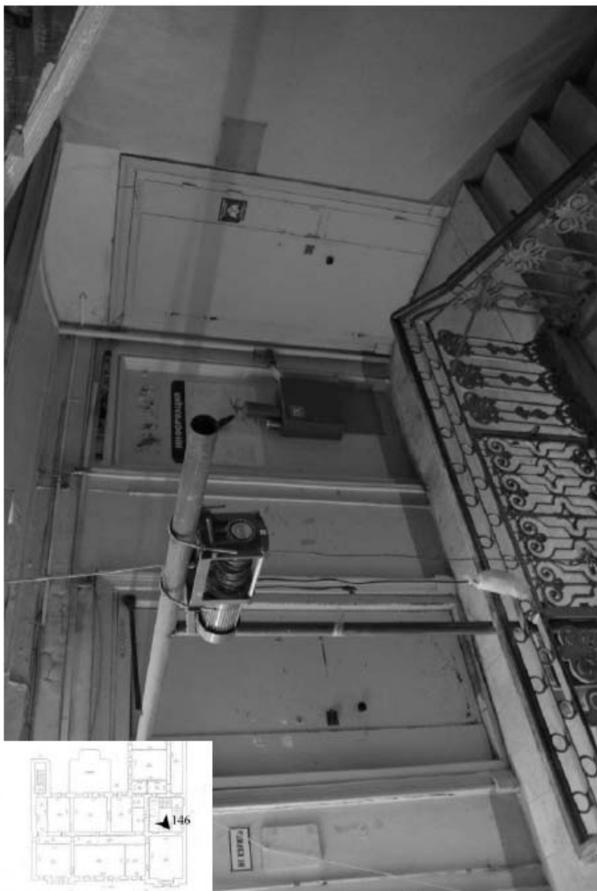
146. Вид на лестничную площадку 4 этажа.
