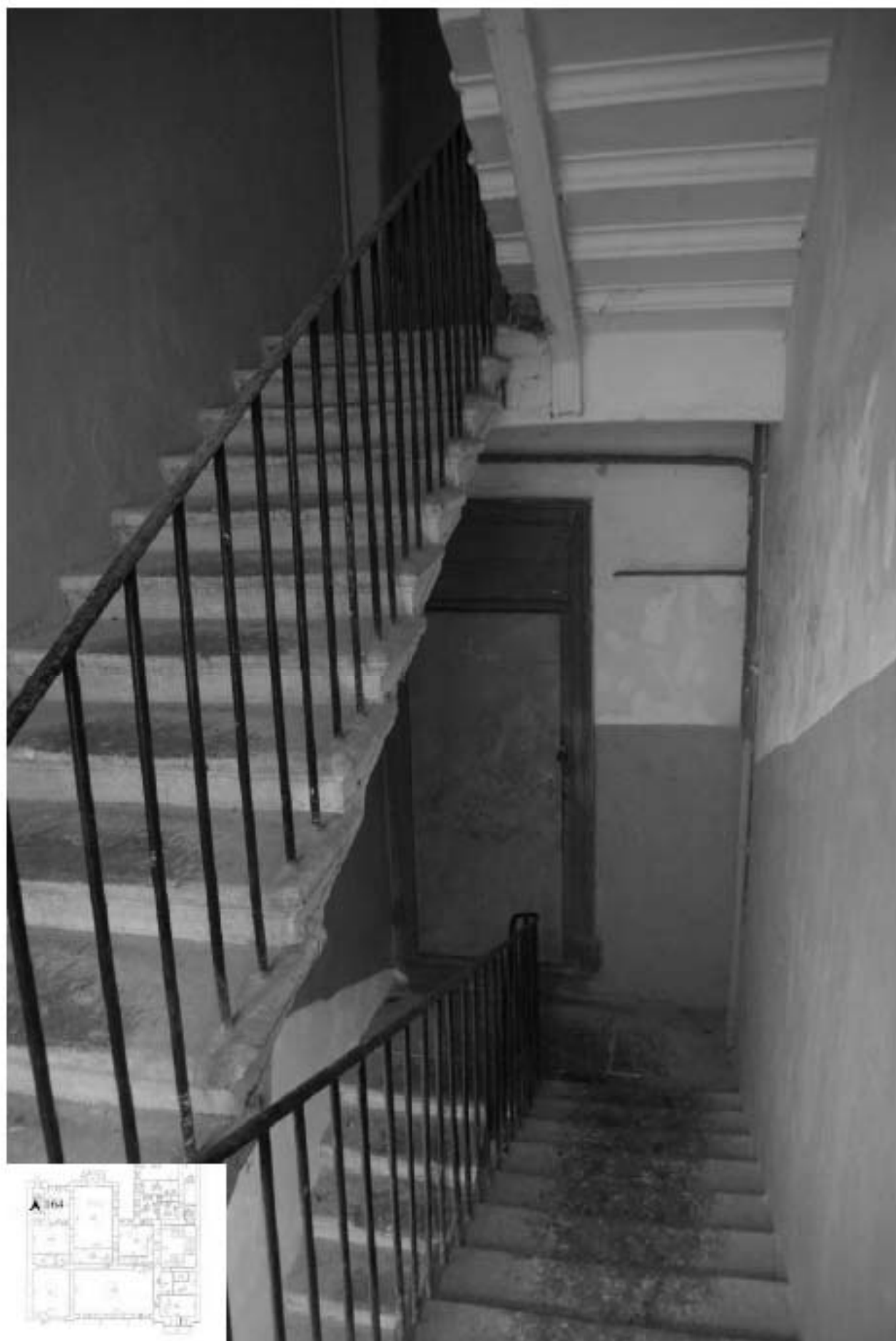
164. Лестница 2ЛК. Вид на лестничную площадку 1 этажа.
