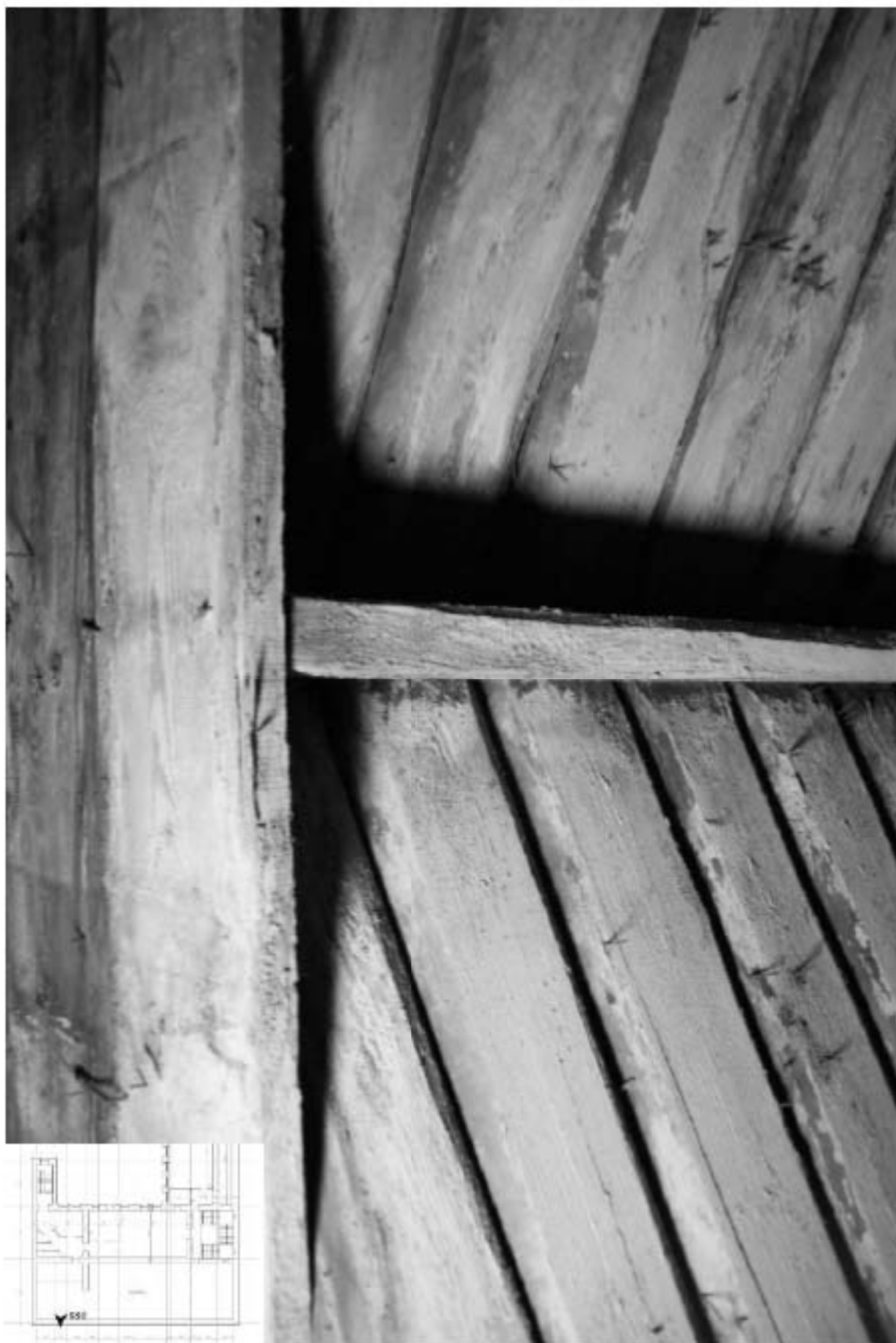
880. Этаж 5, интерьер чердака.
