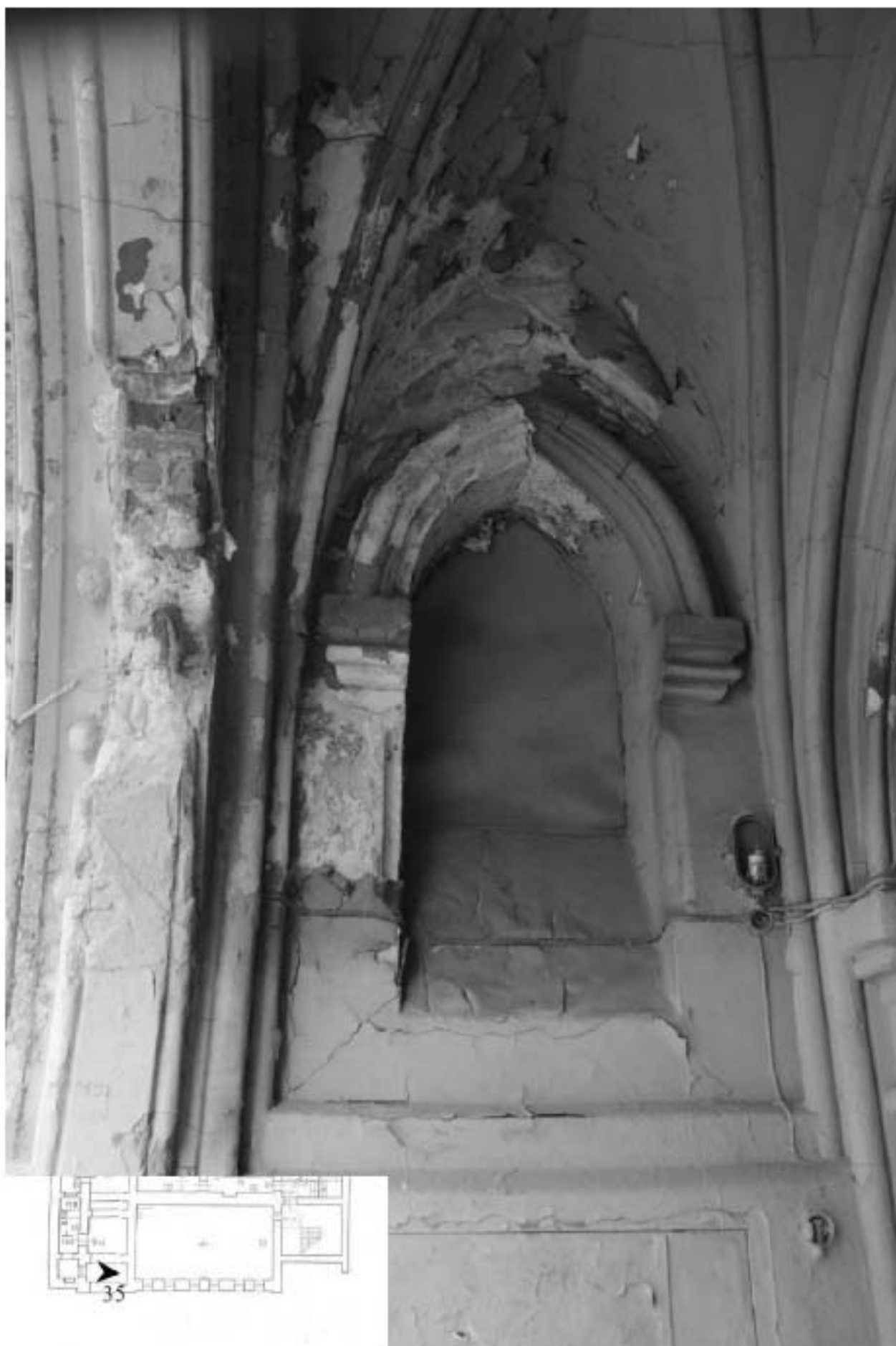
35. Фрагмент проездной арки.
