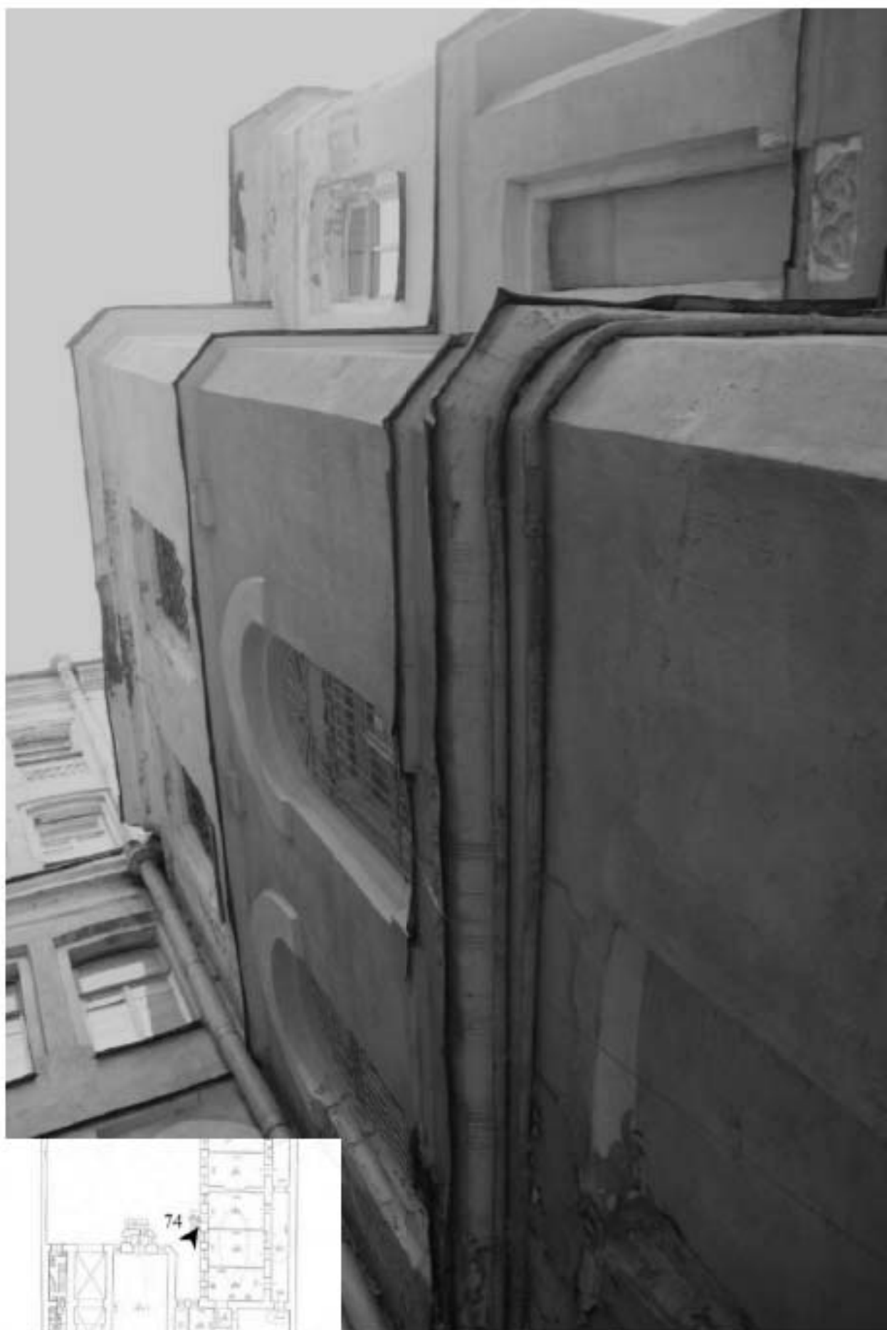
74. Фрагмент дворового фасада лицевого корпуса.
