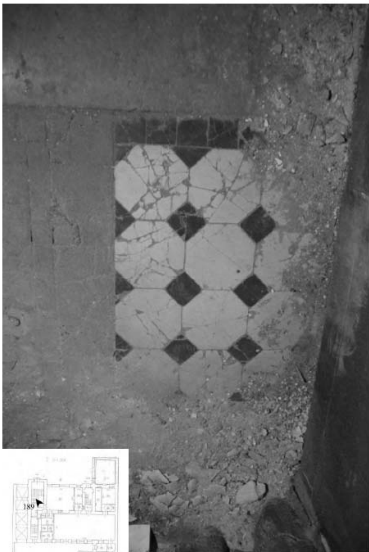
189. Лестница 3ЛК. Фрагмент покрытия лестничной площадки 1 этажа.
