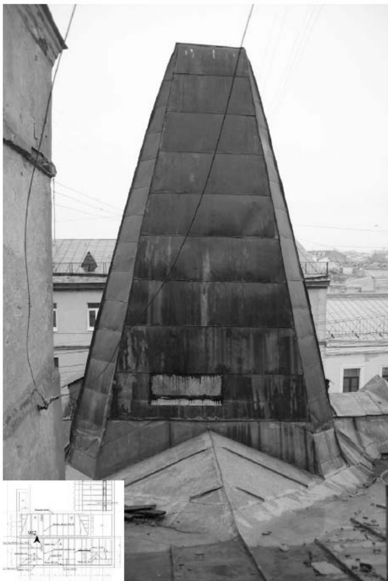
902. Чердак. Вид на кровлю.
