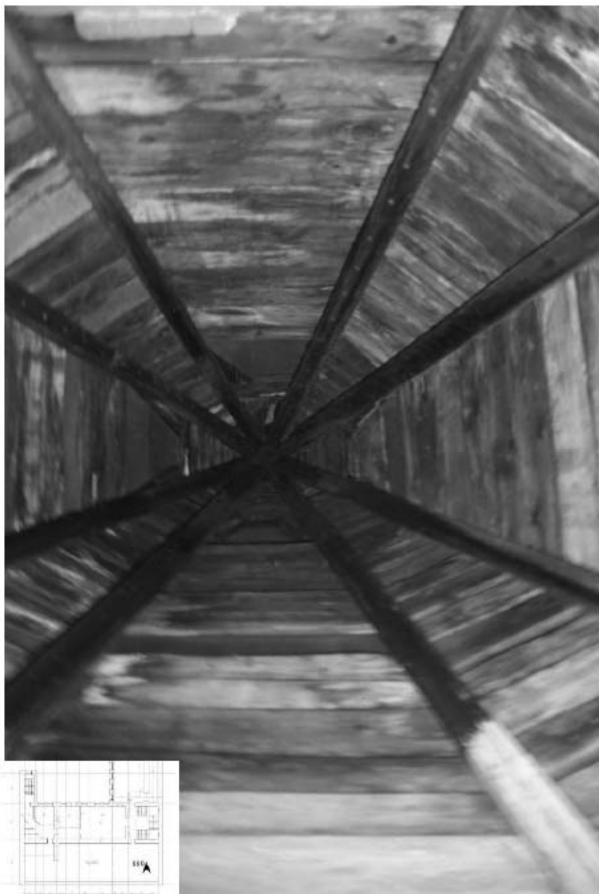
889. Этаж 5, интерьер чердака.
