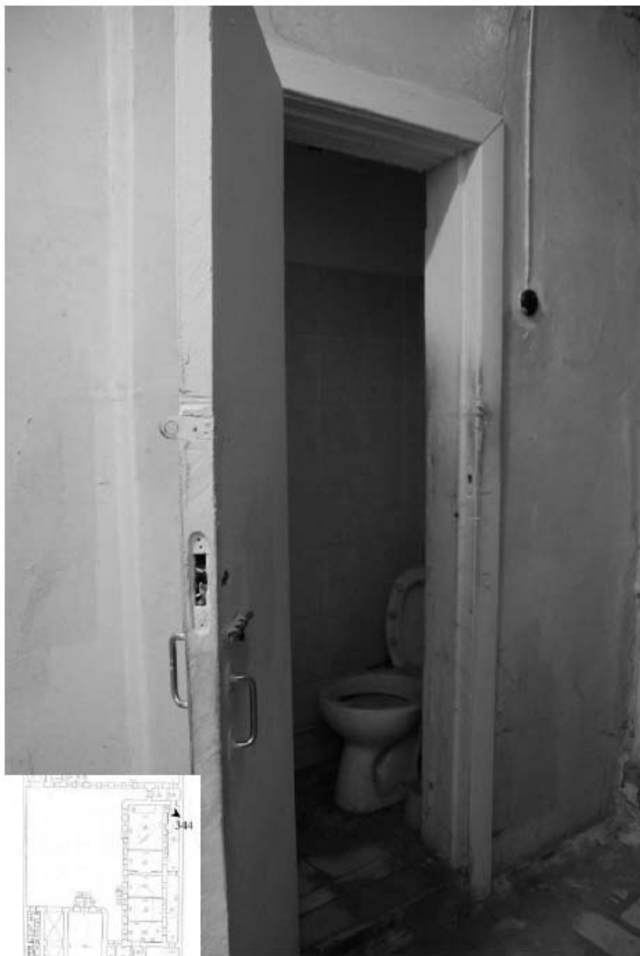
344. Этаж 1, помещение 15-Н. Вид коридора.
