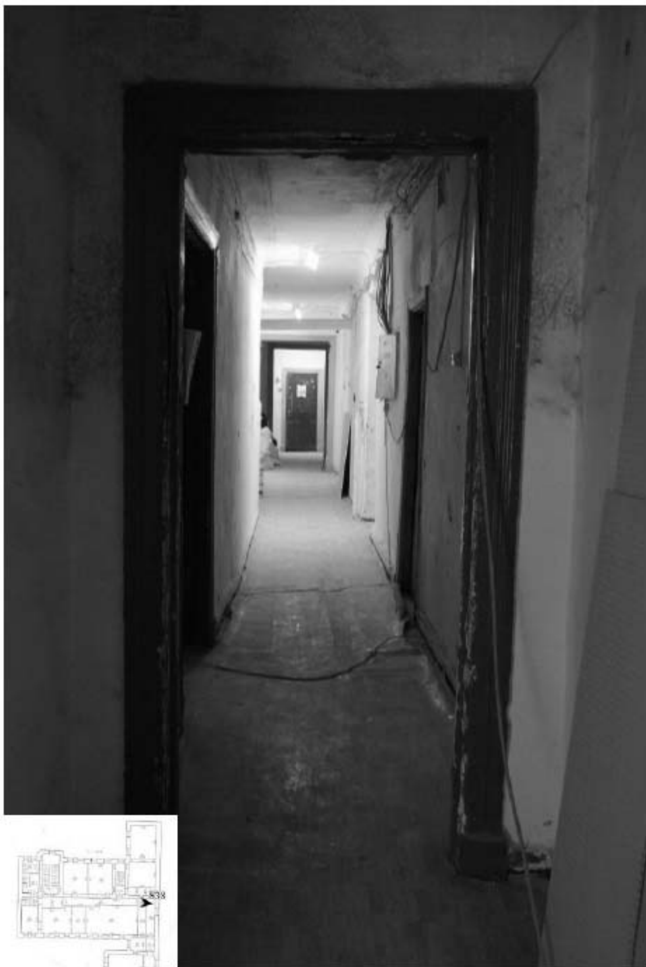
838. Этаж 5, помещение 19-Н. Вид коридора.
