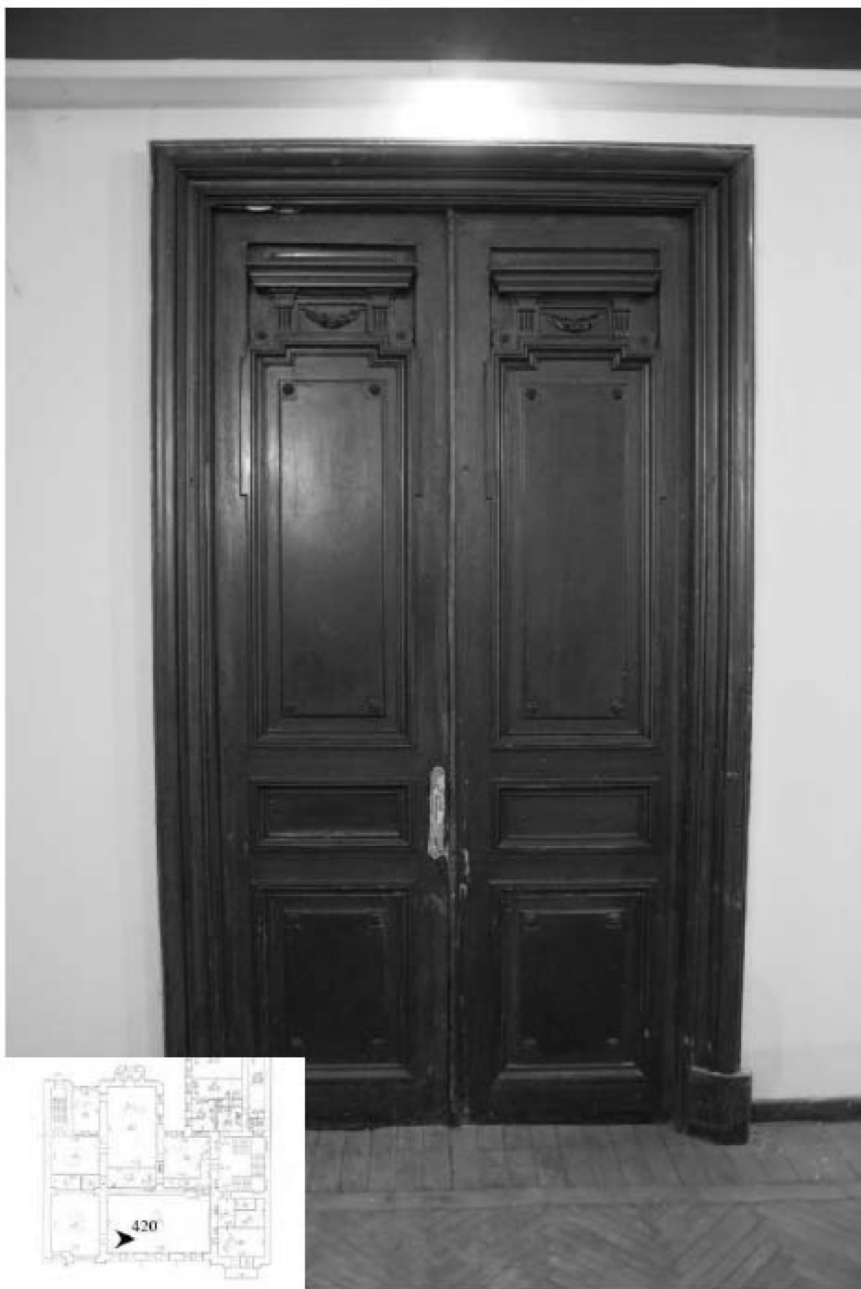
420. Этаж 2, помещение 26-Н. Интерьер комнаты 103,1 кв.м.
