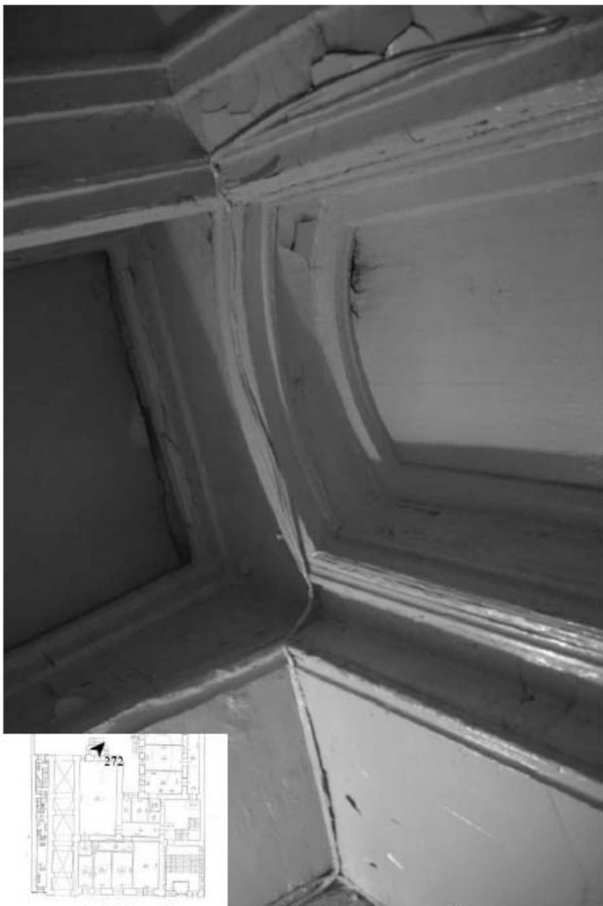
272. Этаж 1, помещение 20-Н. Интерьер входной группы.
