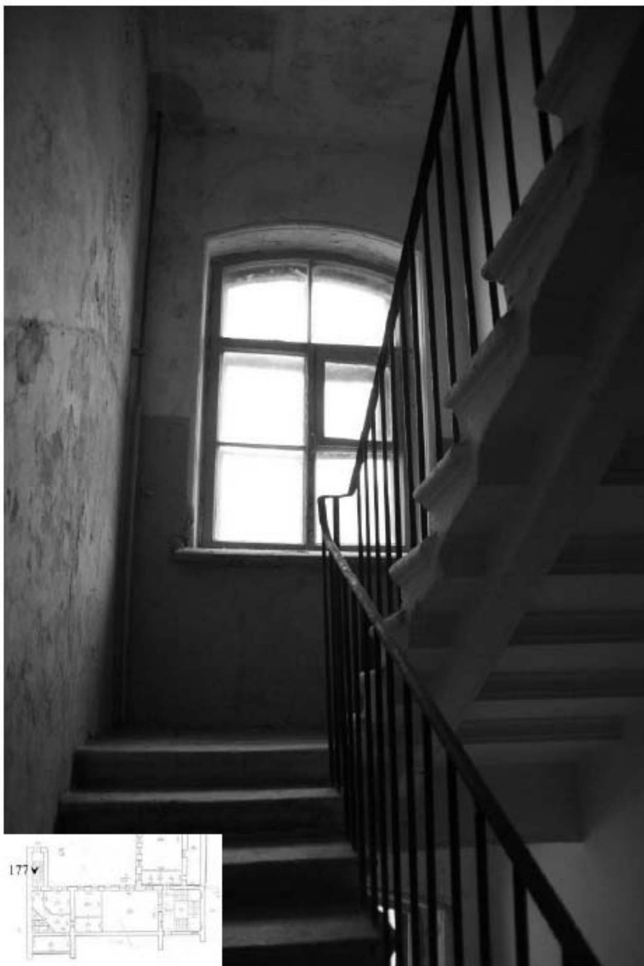
177. Лестница 2ЛК. Лестничная площадка между 4 и 5 этажами.
