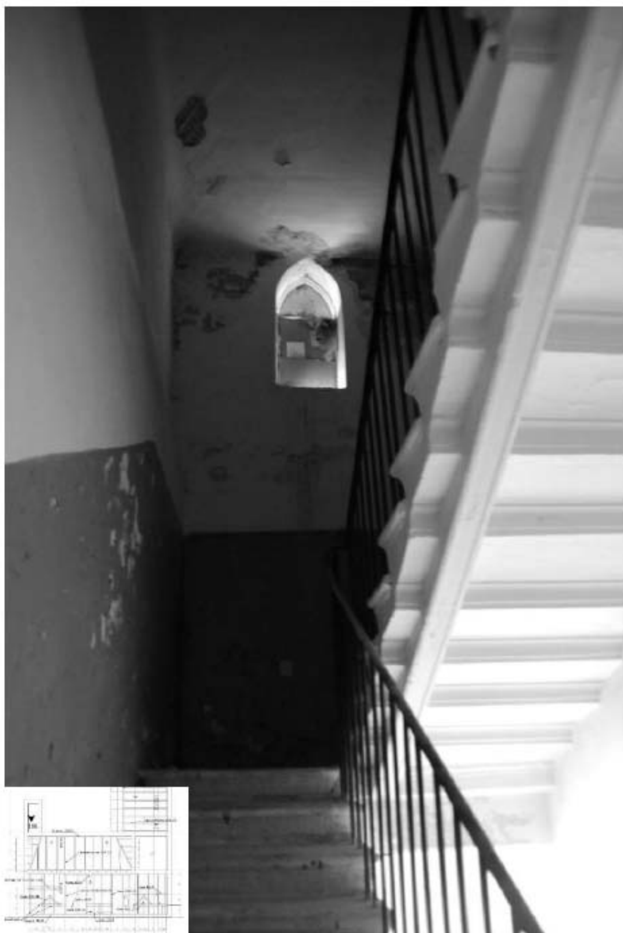
180. Лестница 2ЛК. Лестничная площадка между 5 этажом и чердаком.
