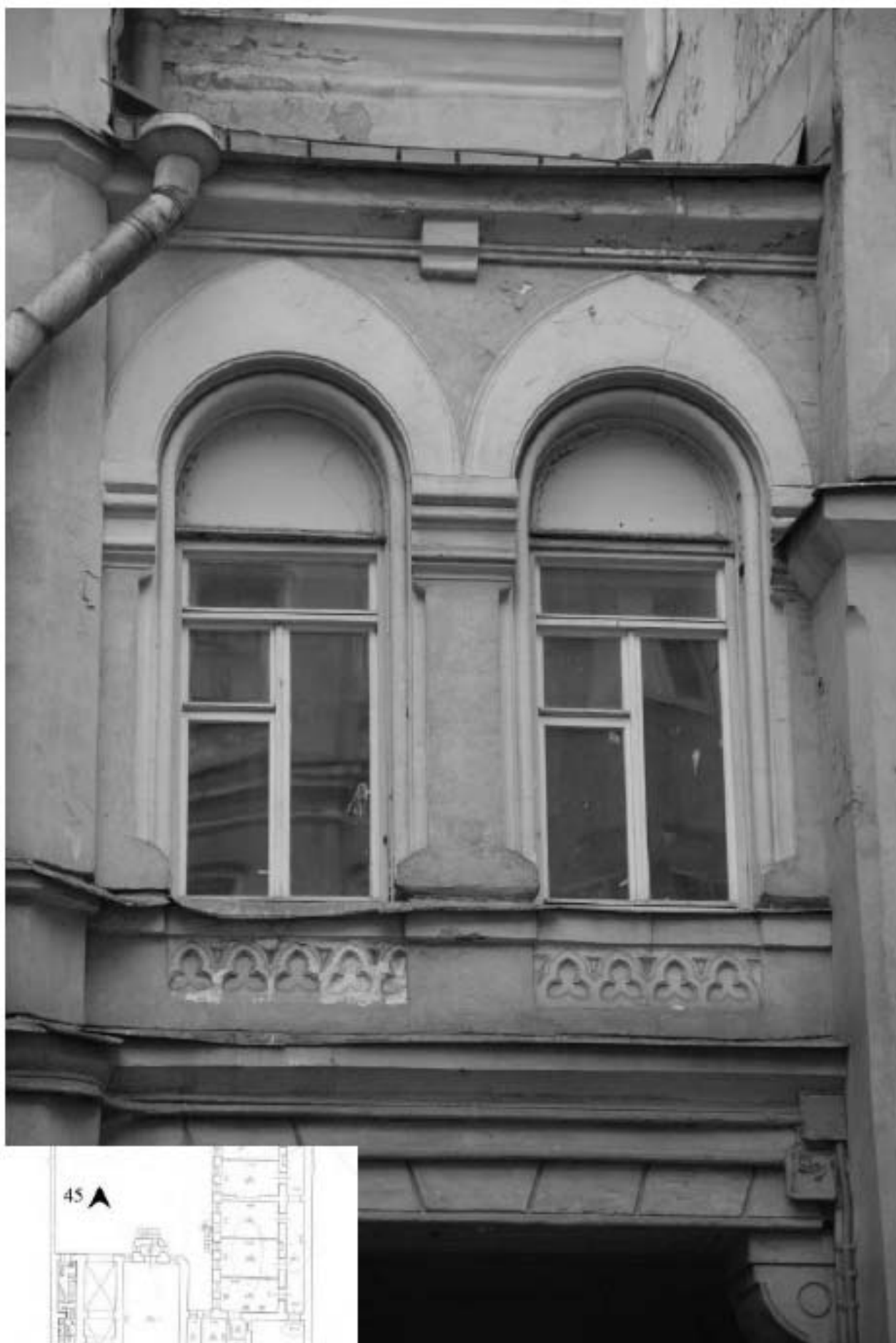
45. Фрагмент дворового фасада лицевого корпуса.
