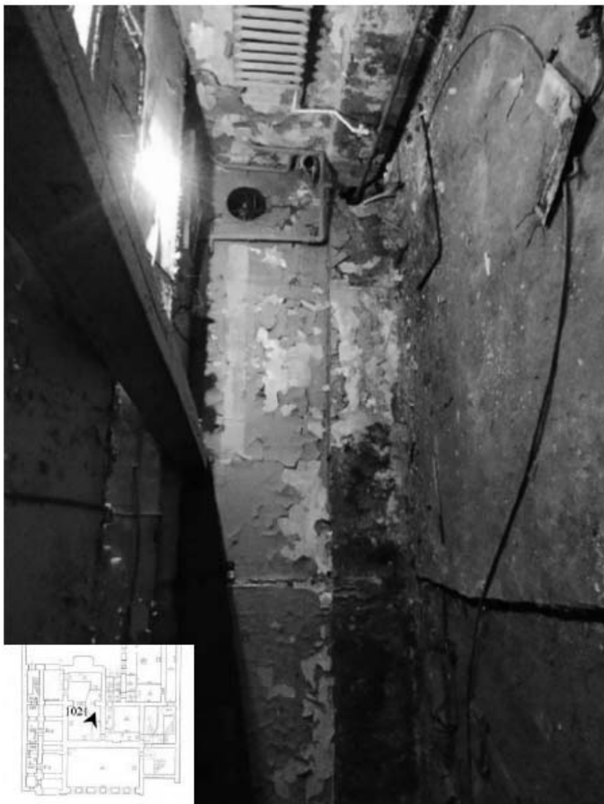
1021. Подвал, помещение 6-Н. Интерьер комнаты 57,8 кв.м.
