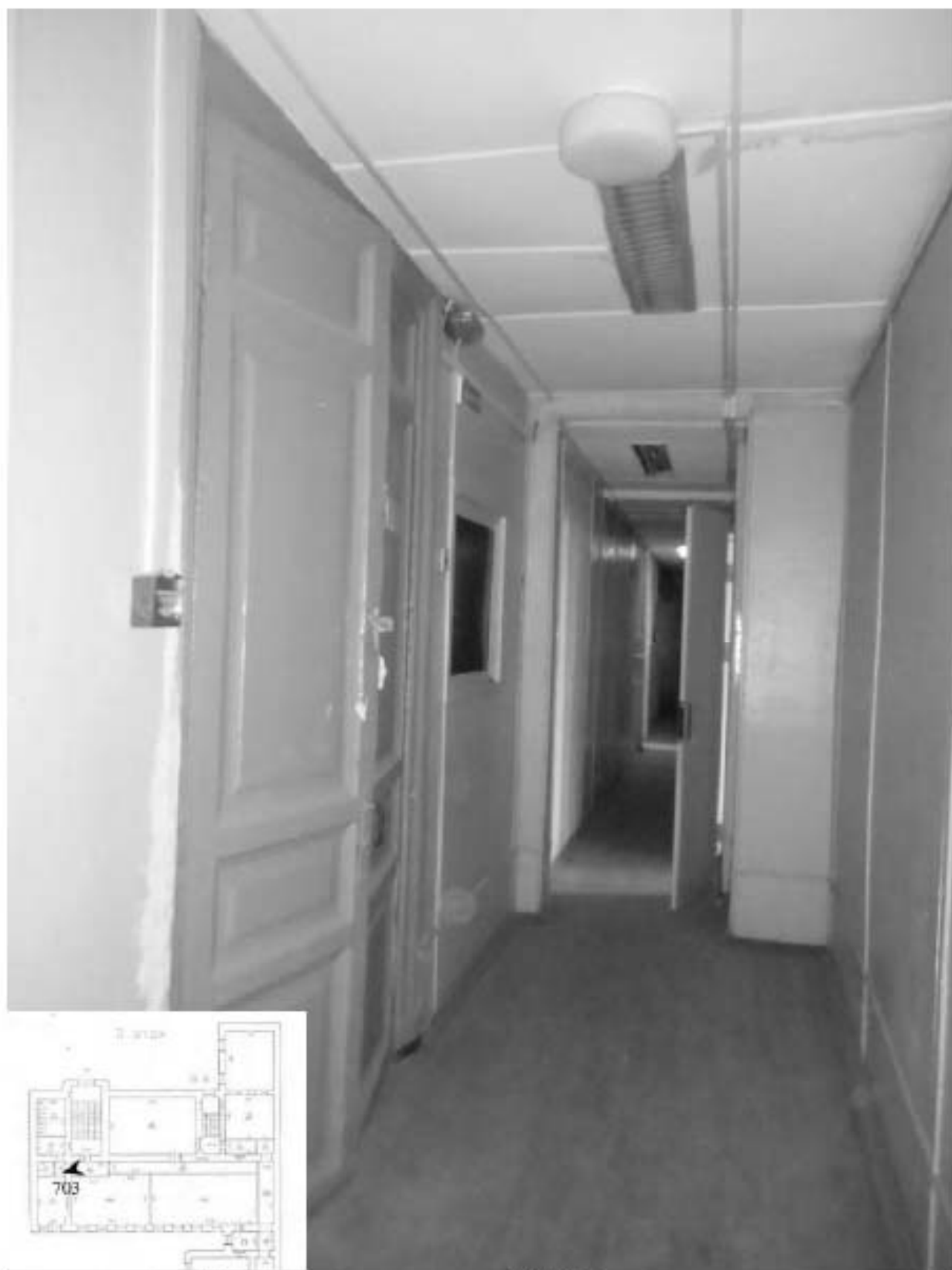
703. Этаж 3, помещение 17-Н. Вид коридора.
