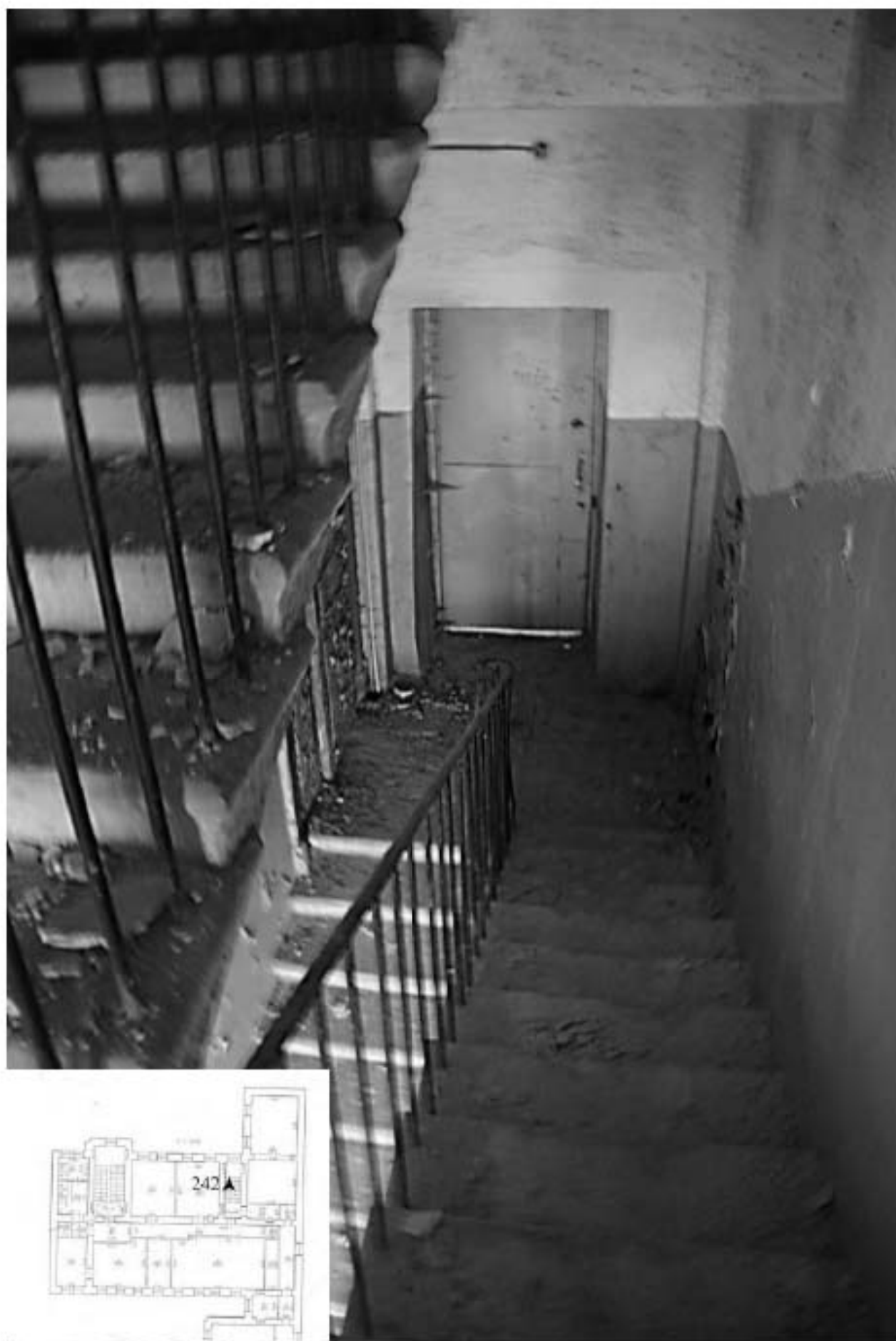
242. Лестница 4ЛК. Лестничная площадка 5 этажа.
