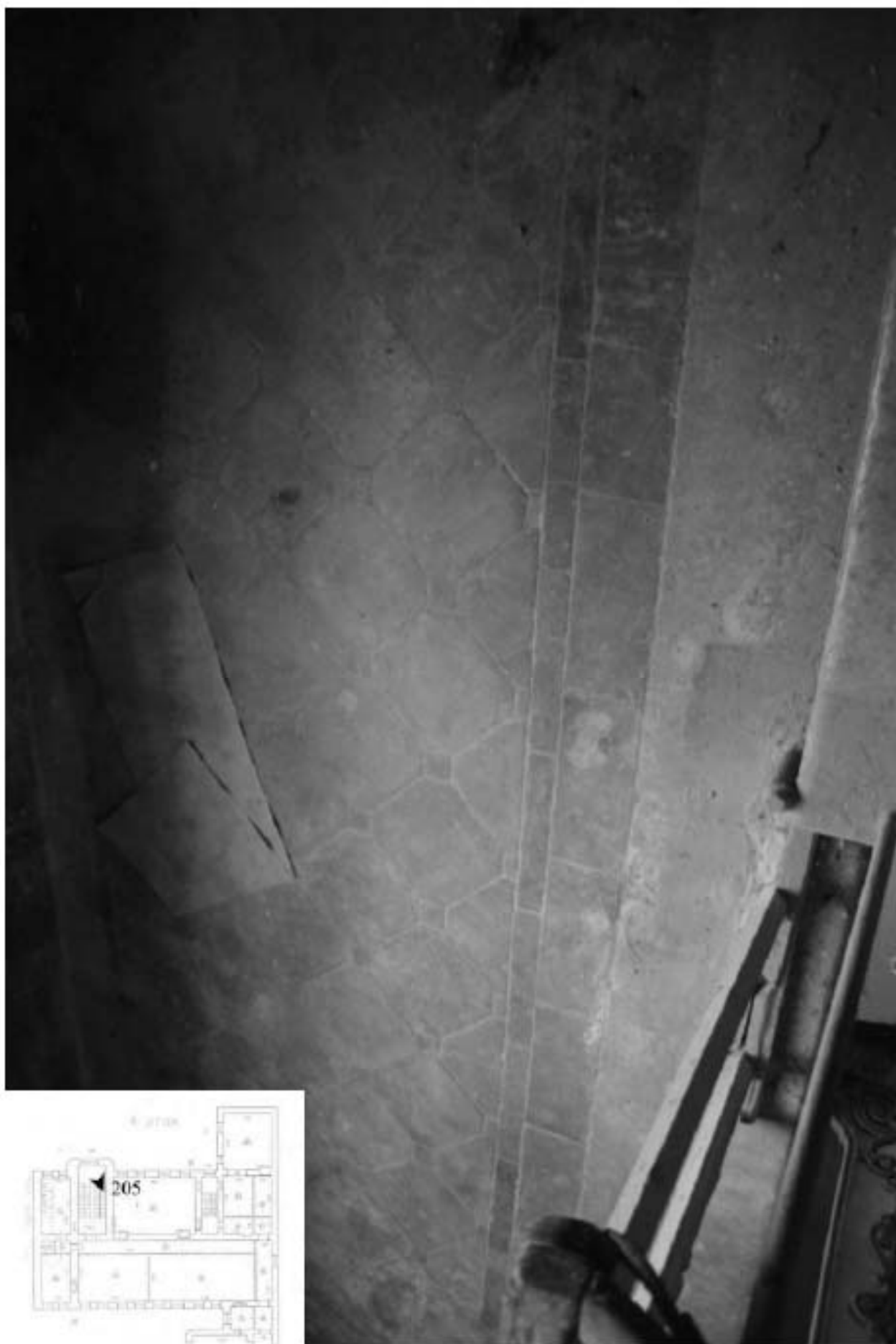
205. Лестница ЗЛК. Покрытие лестничной площадки.
