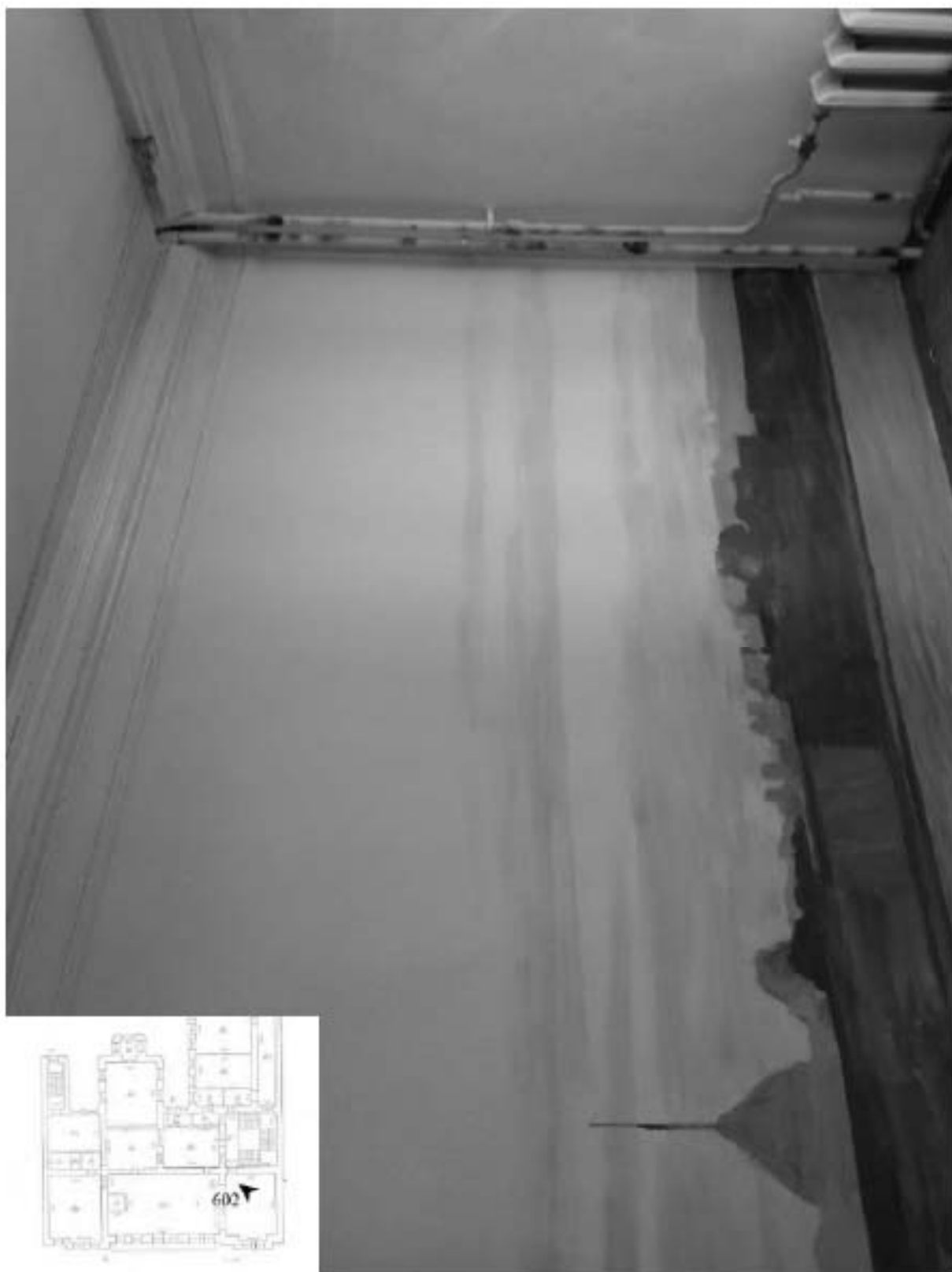
602. Этаж 3, помещение 37-Н. Интерьер комнаты 152,4 кв.м.
