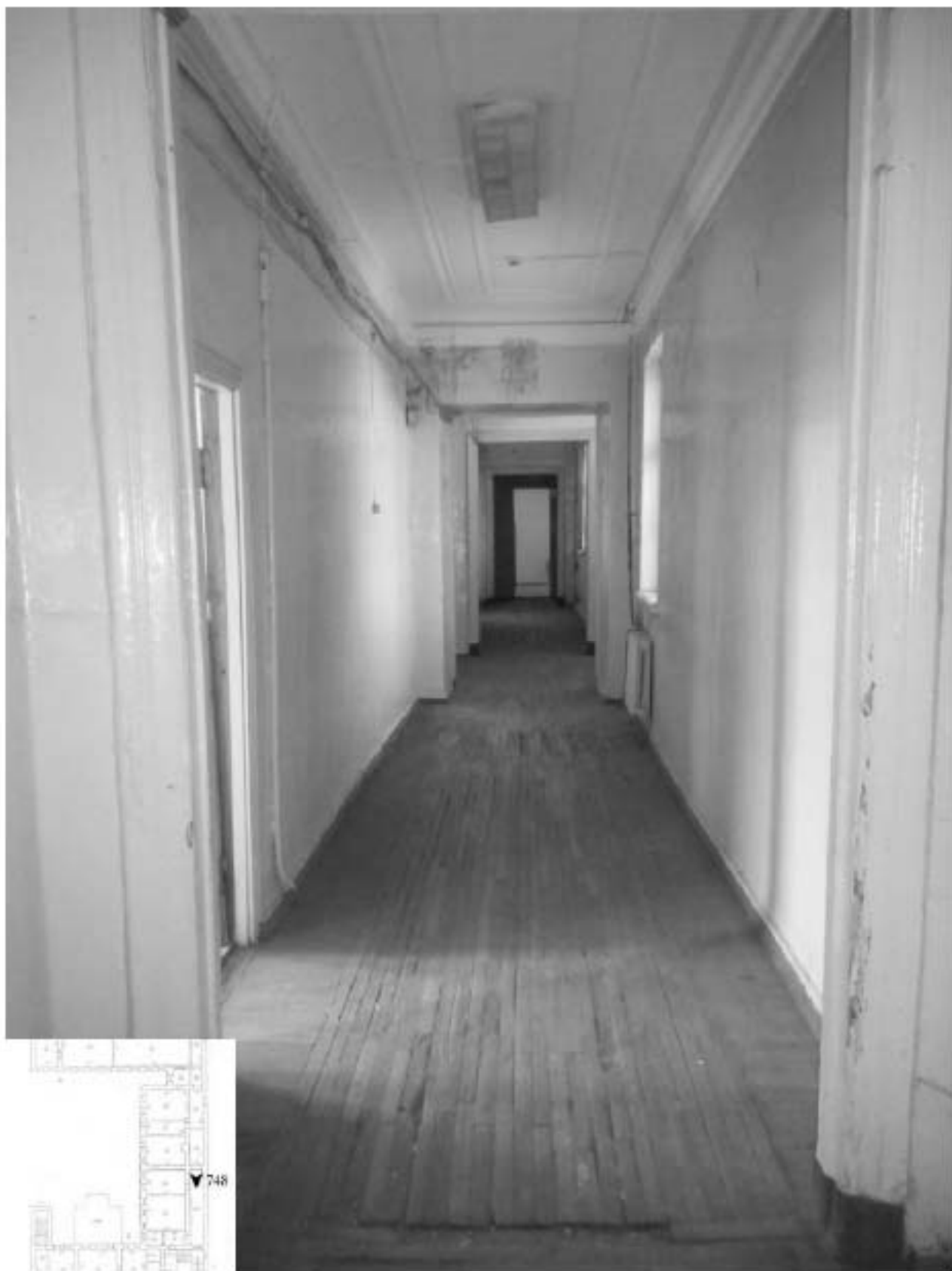
748. Этаж 4, помещение 40-Н. Вид коридора.
