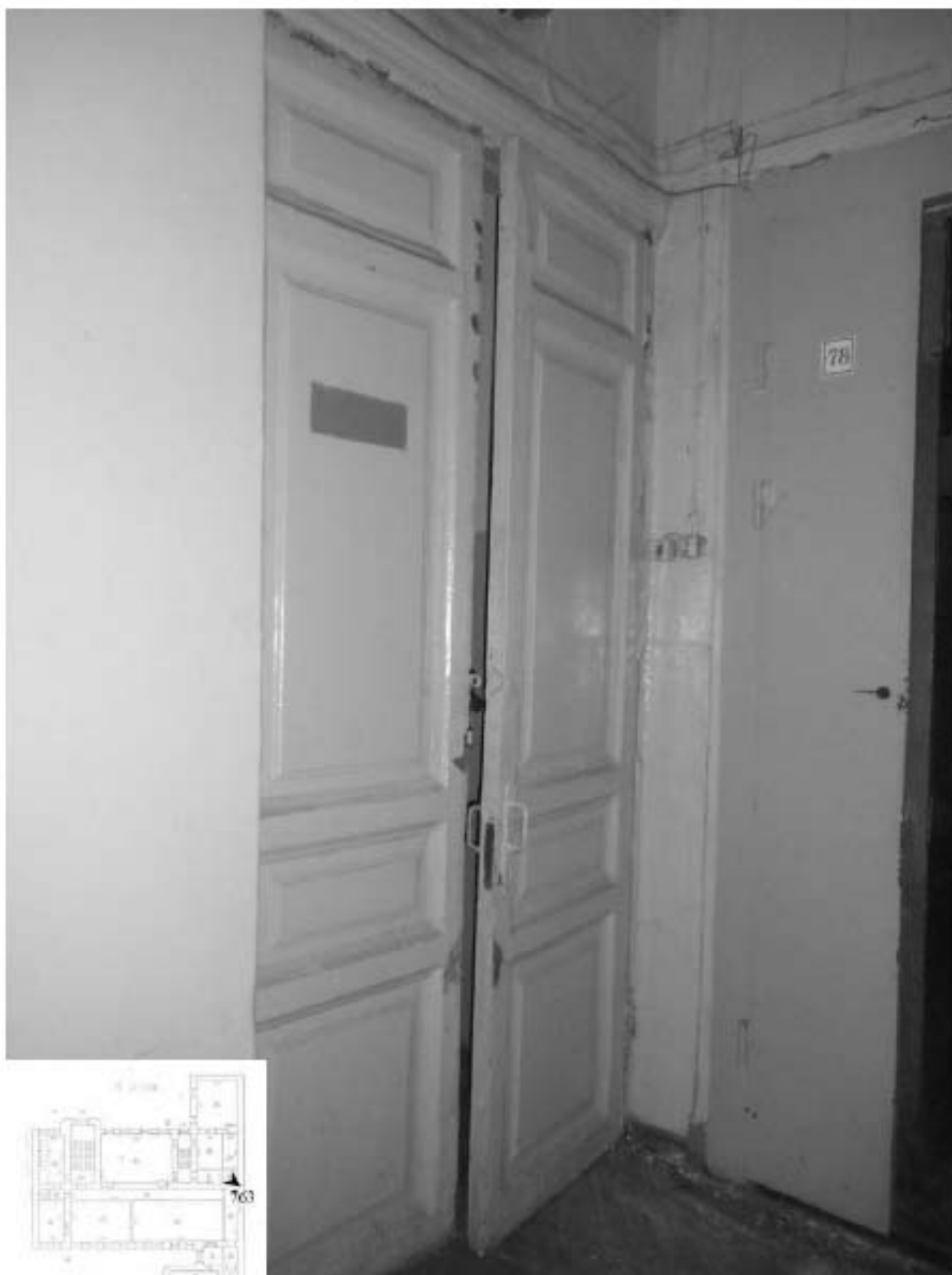
763. Этаж 4, помещение 40-Н. Дверь комнаты 6,0 кв.м.
