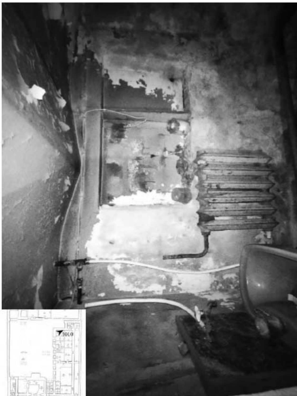
1010. Подвал, помещение 6-Н. Интерьер комнаты 2,5 кв.м.
