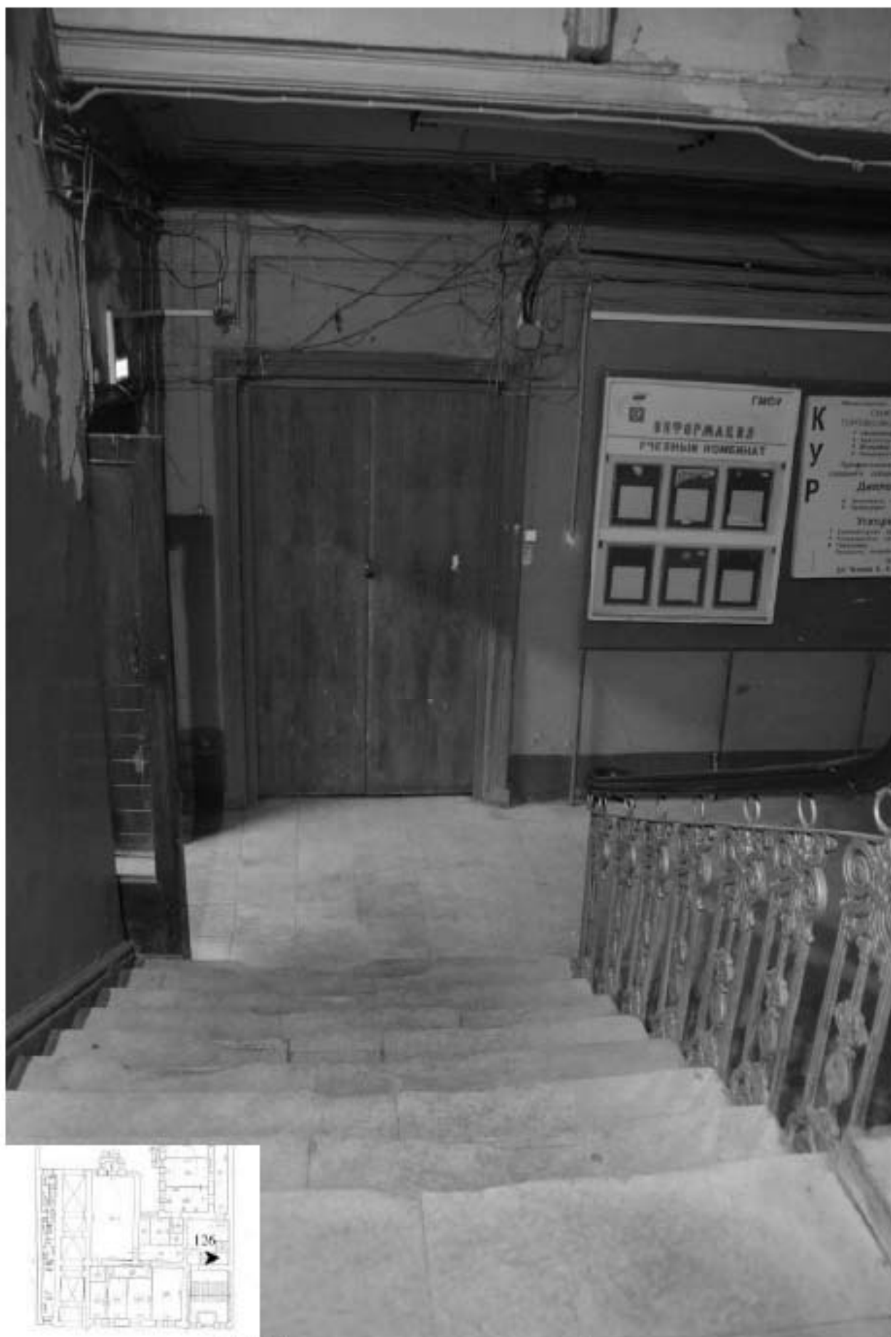
126. Вид на дверь в помещения 1 этажа.
