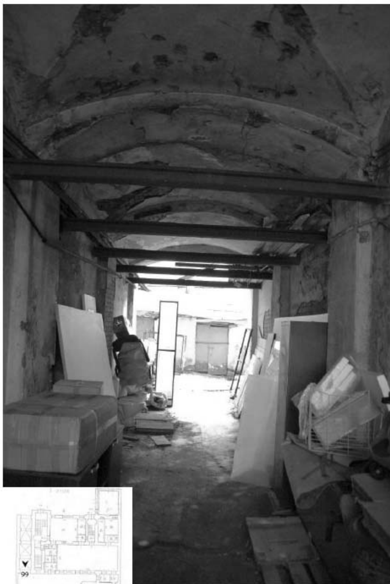
99. Воротный проезд дворового корпуса. Фрагмент.
