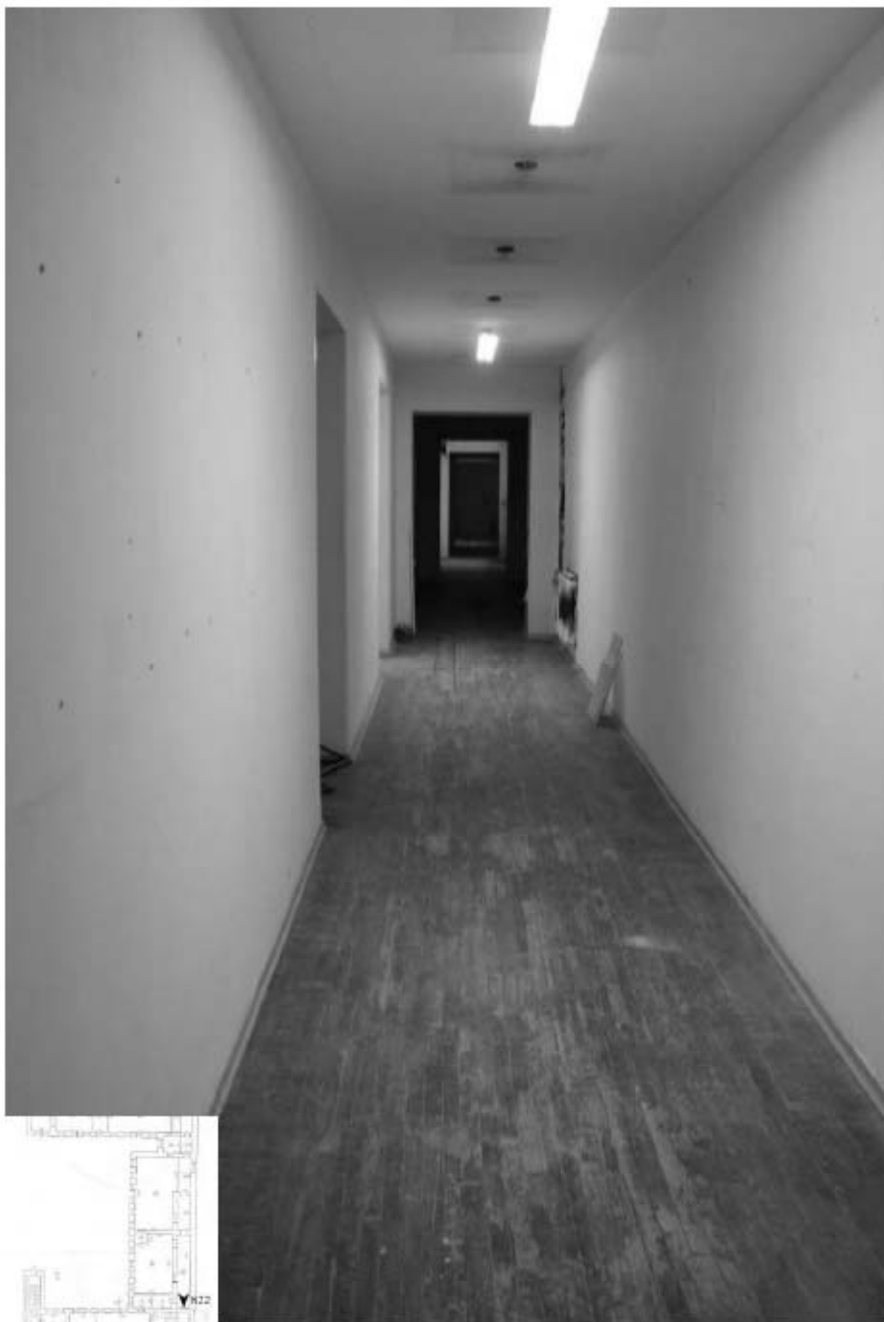
822. Этаж 5, помещение 19-Н. Вид коридора.
