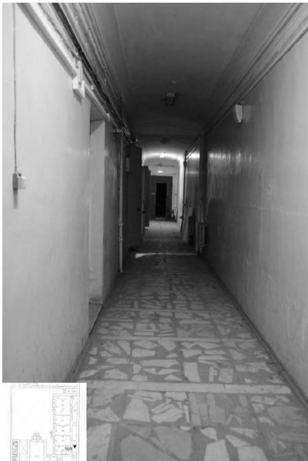
305. Этаж 1, помещение 15-Н. Вид коридора.
