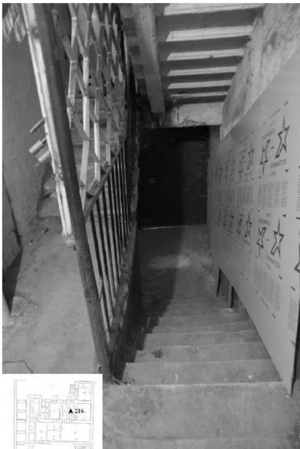
216. Лестница 4ЛК. Вход в подвал.
