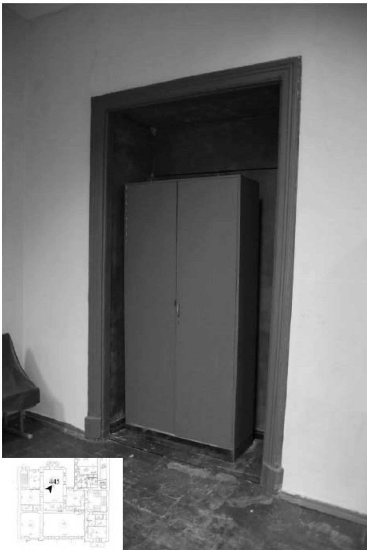
445. Этаж 2, помещение 26-Н. Интерьер комнаты 66,3 кв.м.
