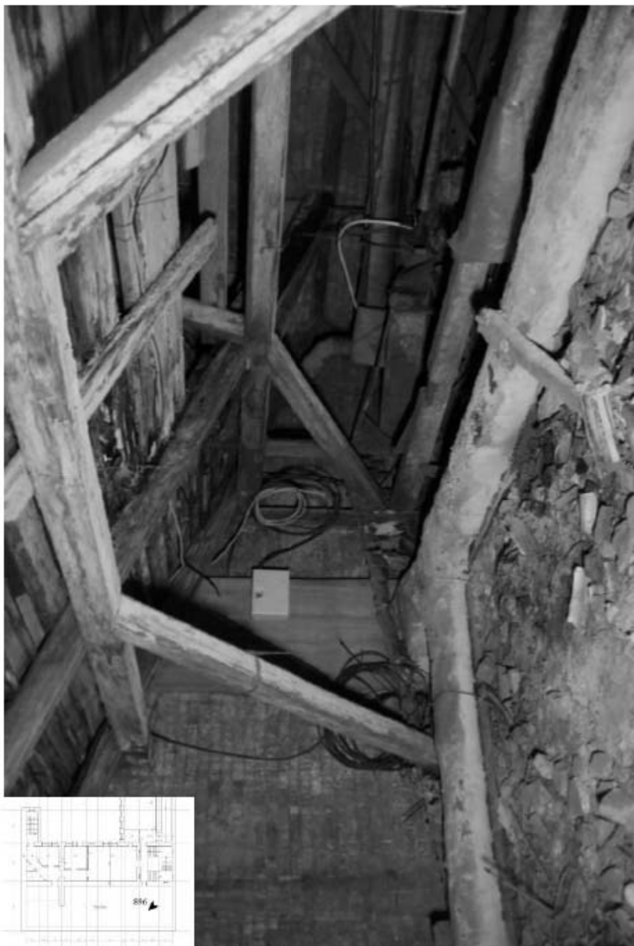
896. Этаж 5, интерьер чердака.
