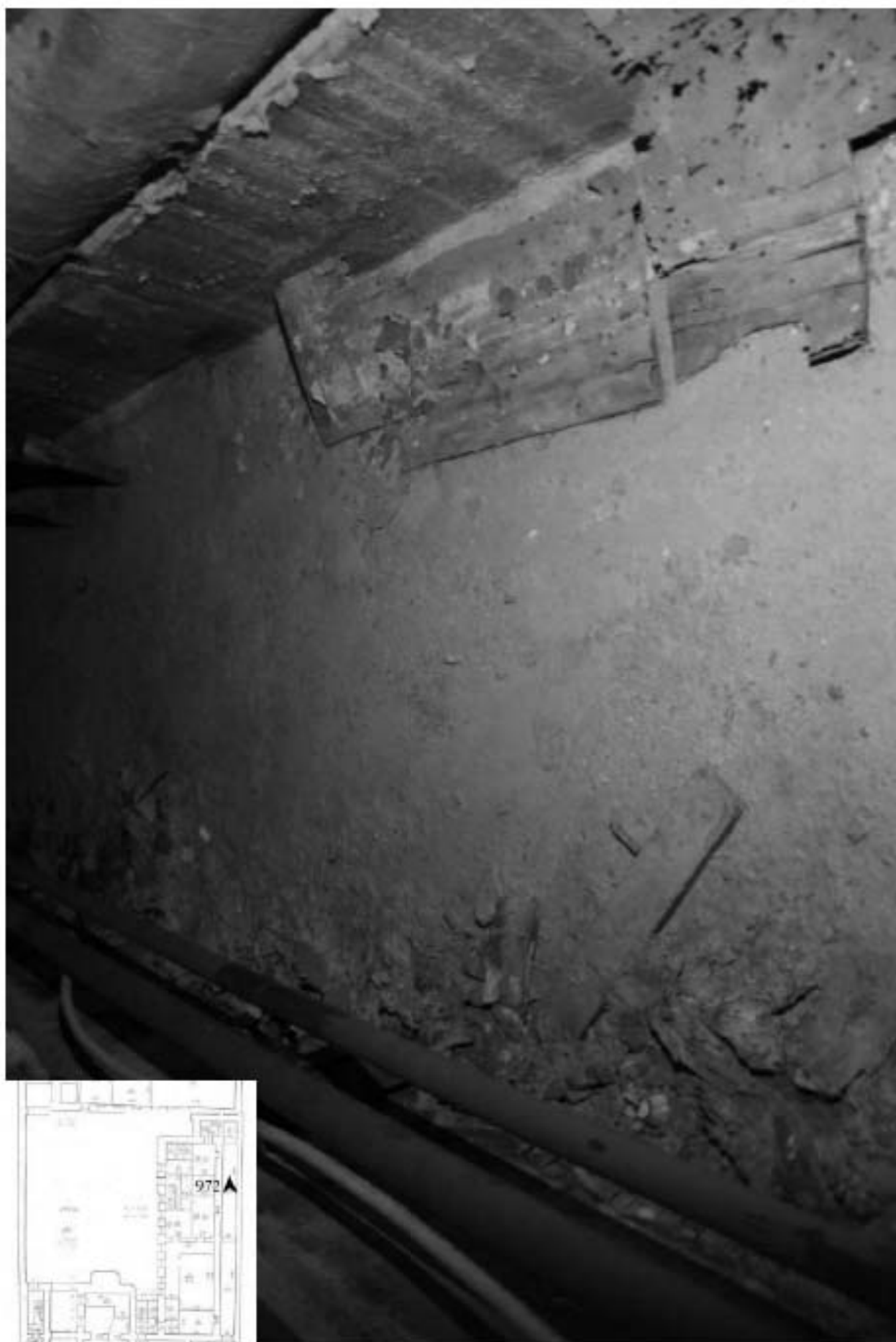
972. Подвал. Интерьер помещения 29-Н.
