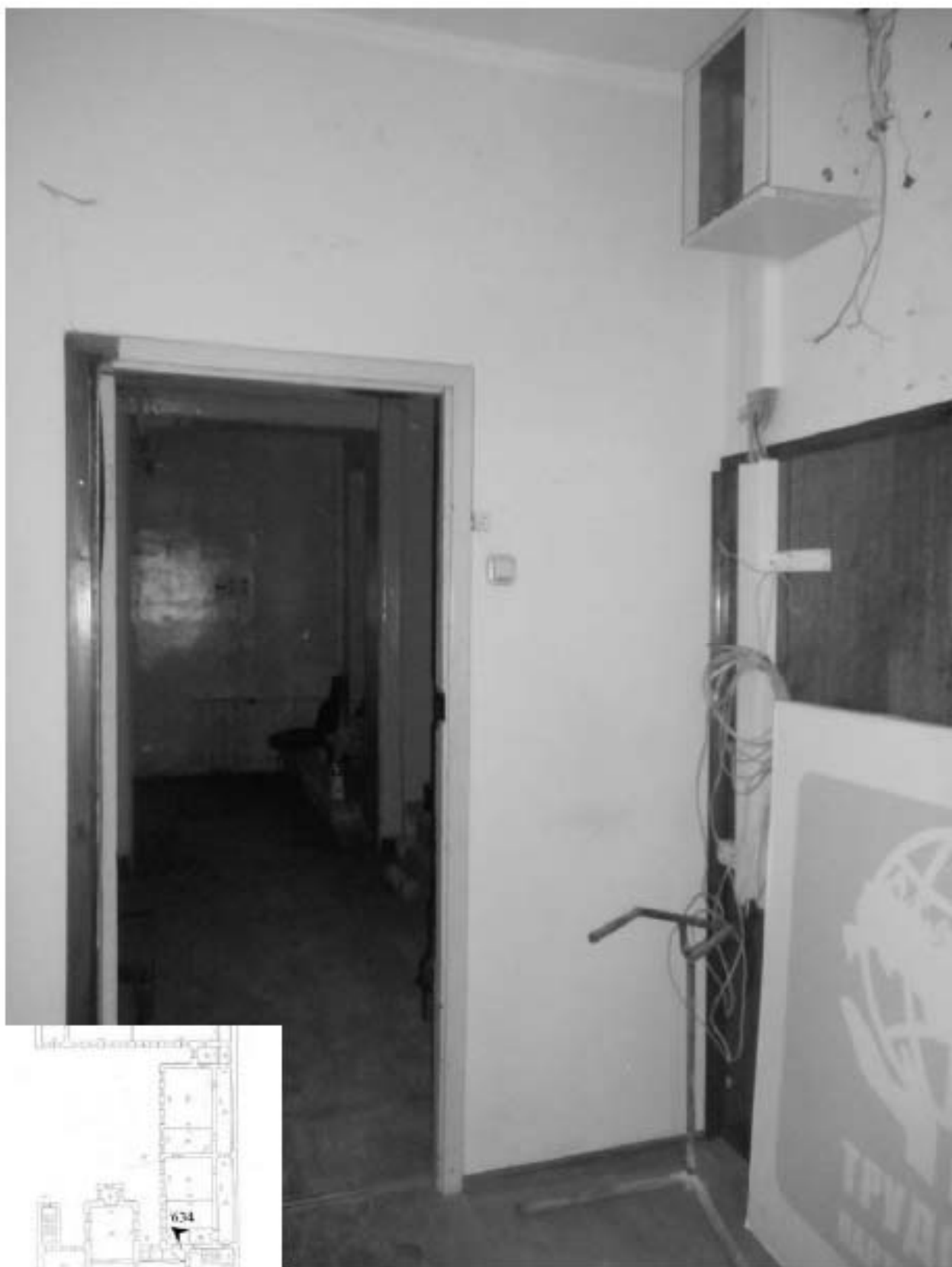
634. Этаж 3, помещение 17-Н. Вид из комнаты 6,4 кв.м.
