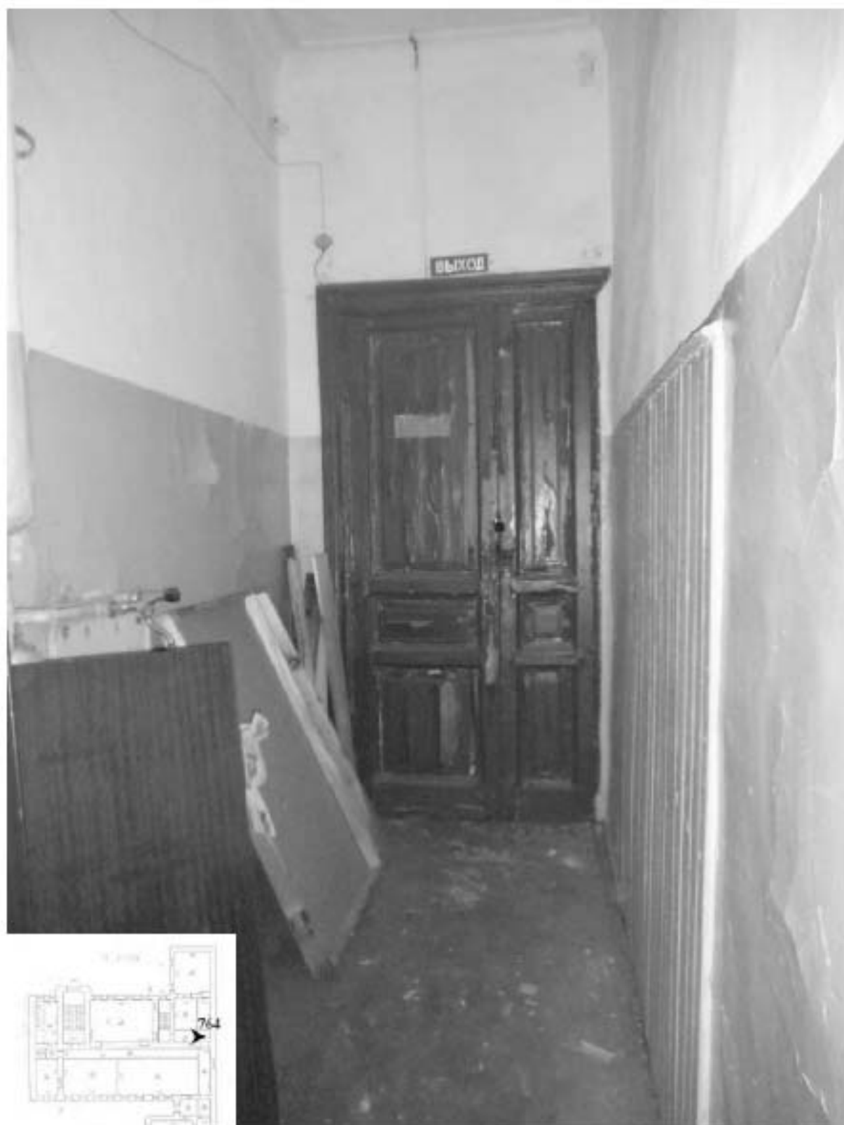
764. Этаж 4, помещение 40-Н. Интерьер комнаты 6,0 кв.м.
