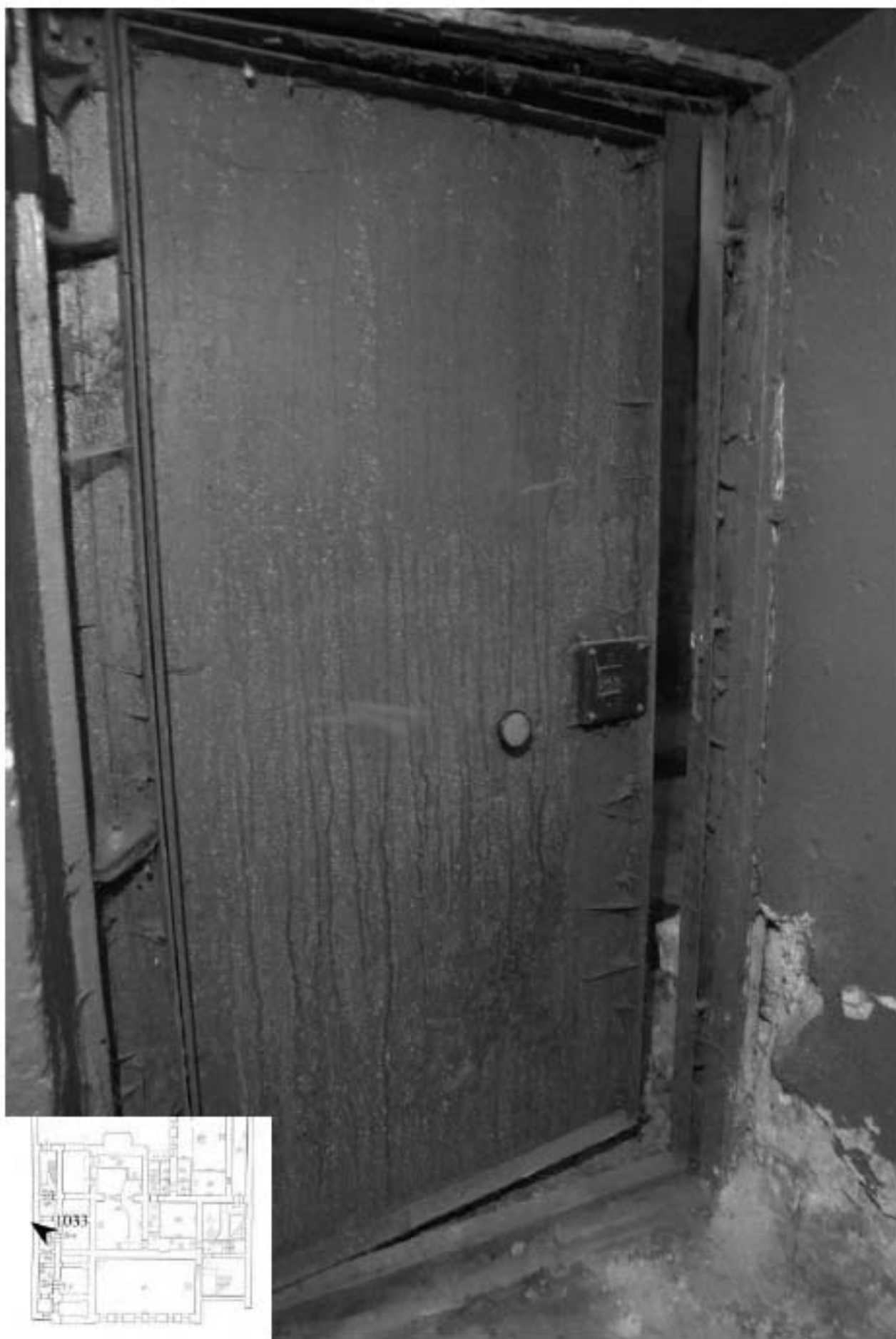
1033. Подвал, интерьер помещения 10-Н.
