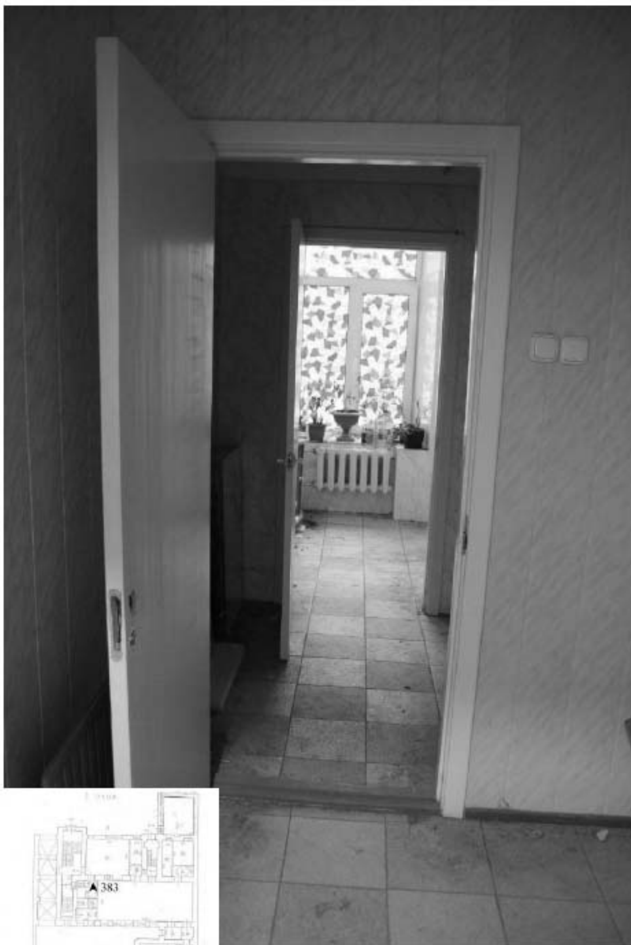
383. Этаж 1, помещение 15-Н. Интерьер душевой.
