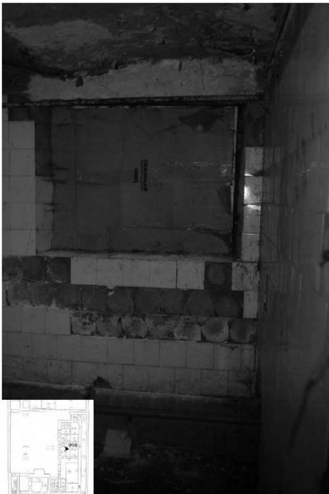
998. Подвал, помещение 6-Н. Интерьер комнаты 10,5 кв.м.
