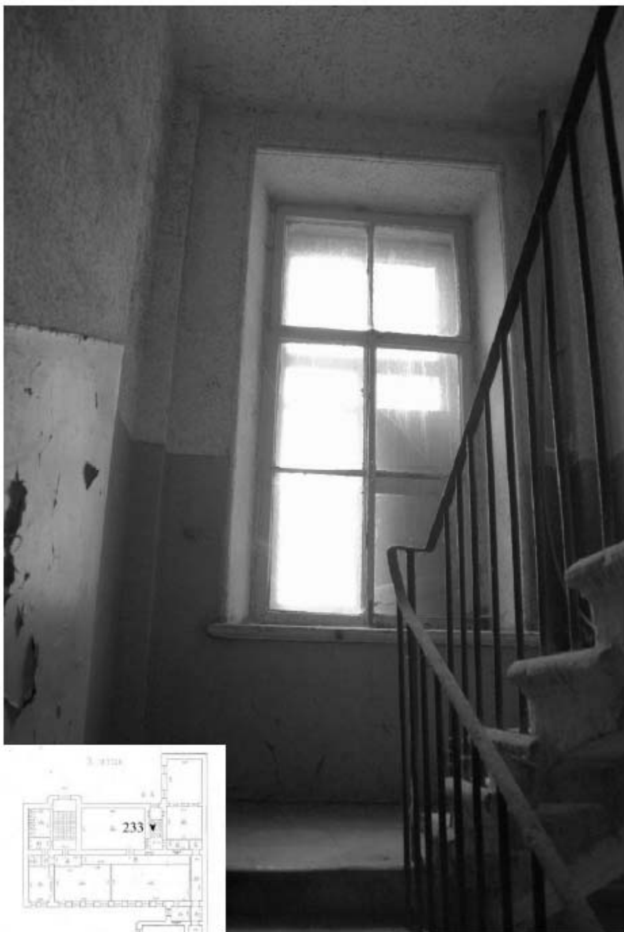
233. Лестница 4ЛК. Лестничная площадка между 3 и 4 этажами.
