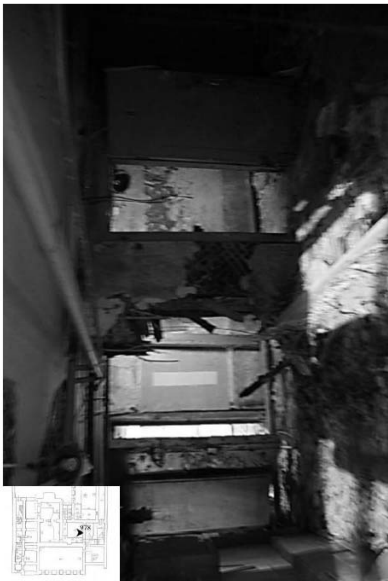
978. Подвал, помещение 6-Н. Интерьер комнаты 20,8 кв.м.
