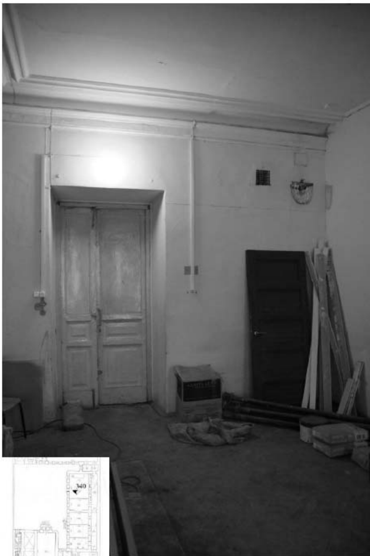
340. Этаж 1, помещение 15-Н. Интерьер комнаты 52,1 кв.м.
