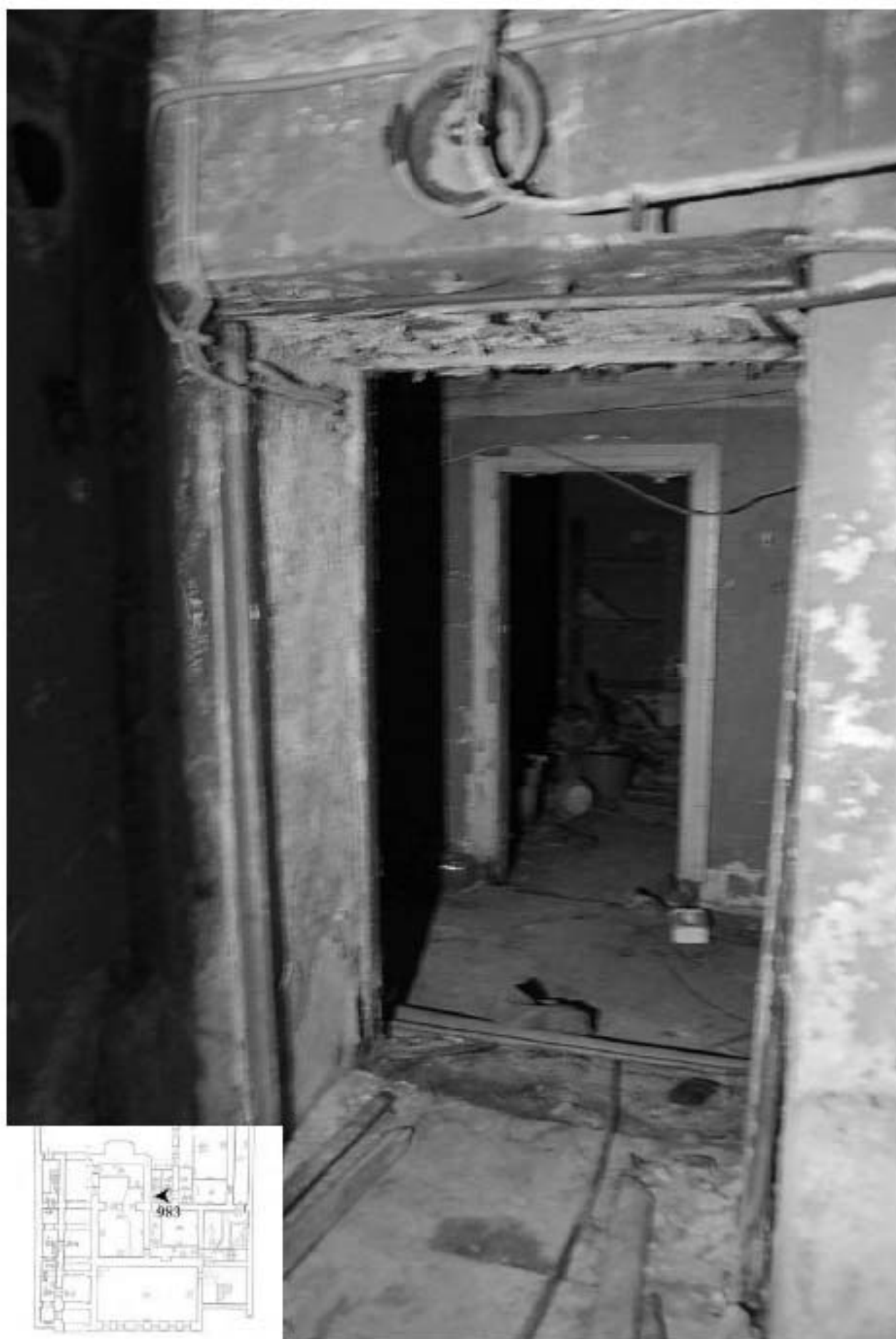
983. Подвал, помещение 6-Н. Вход в комнату 2,2 кв. м.
