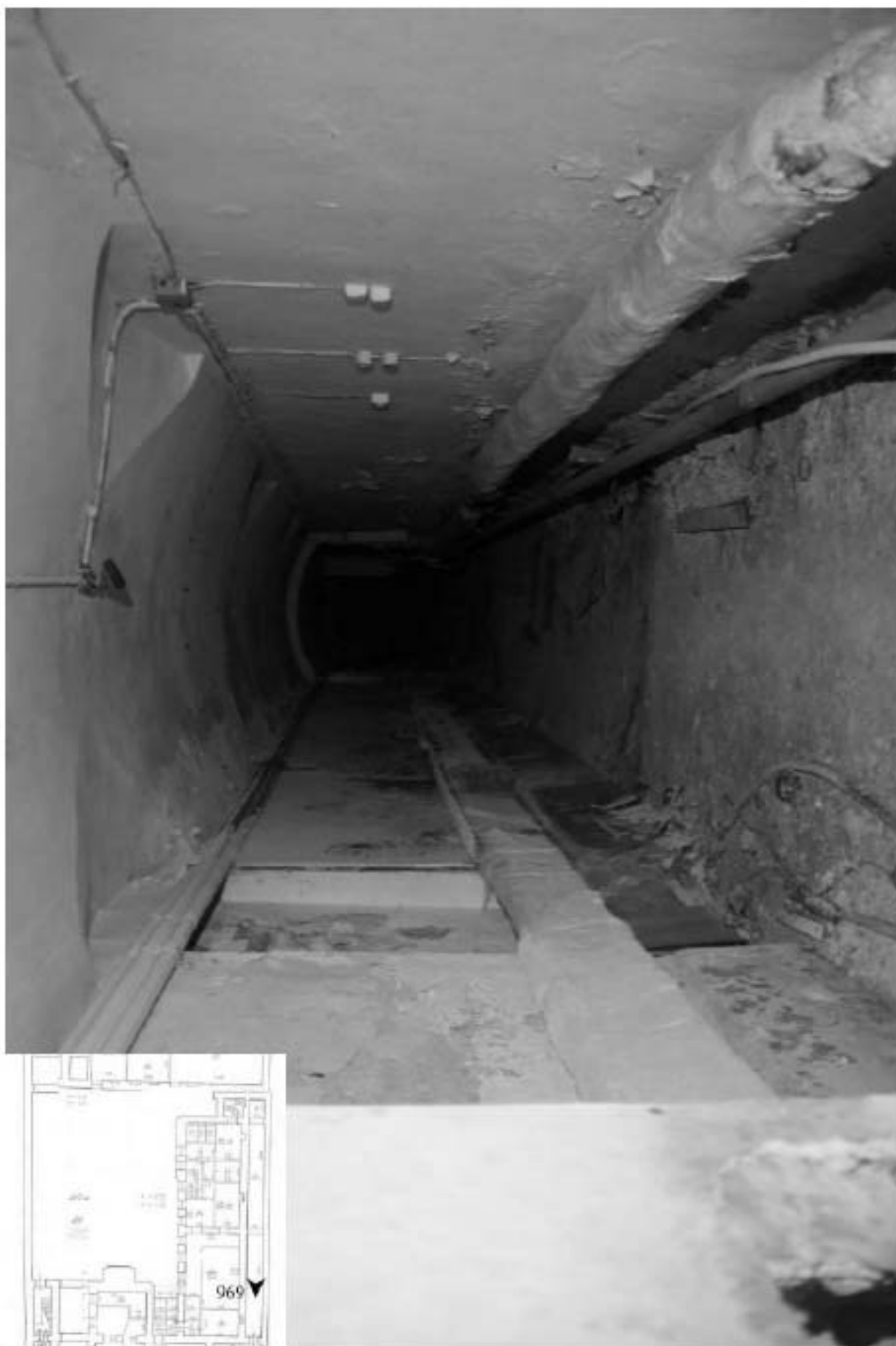
969. Подвал. Интерьер помещения 29-Н.
