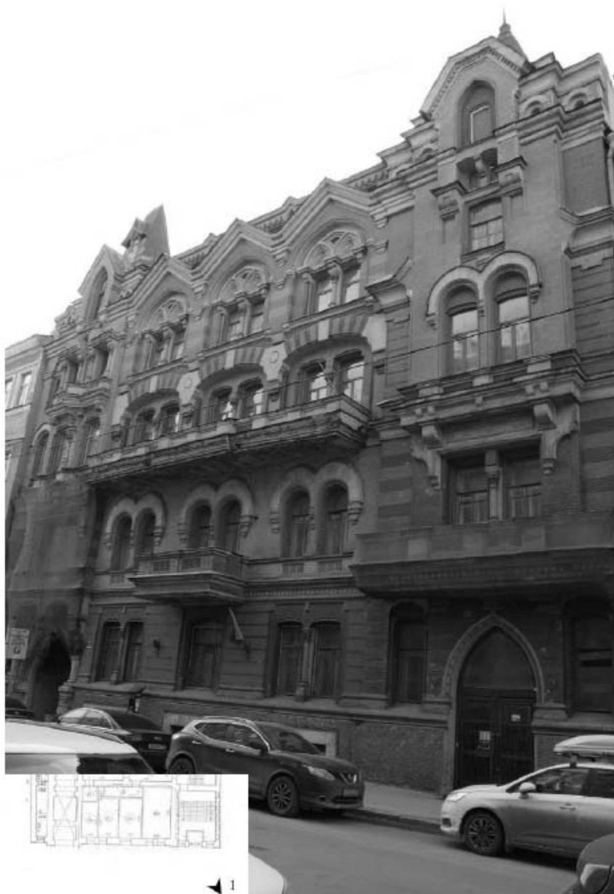
1. Лицевой фасад. Вид с северо-востока.
