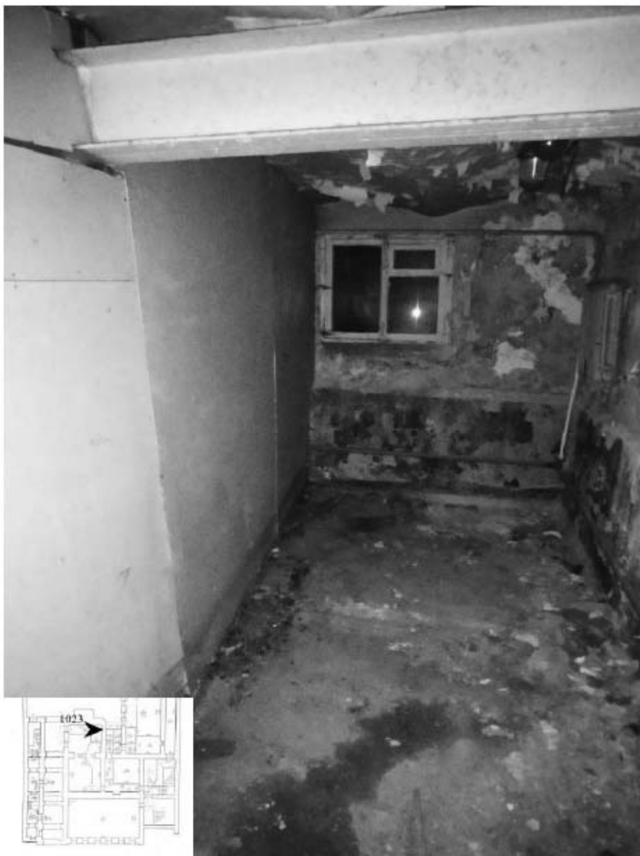
1023. Подвал, помещение 6-Н. Интерьер комнаты 14,9 кв.м.
