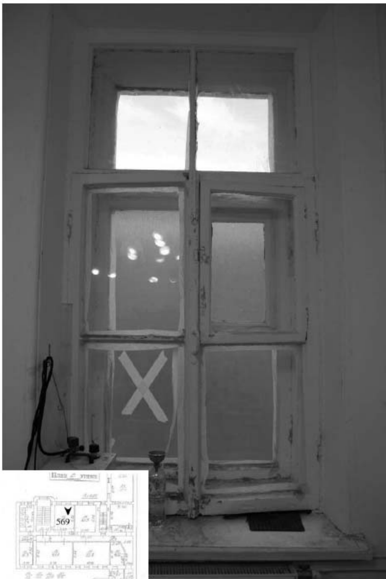
569. Этаж 2, помещение 16-Н. Интерьер комнаты 30,1 кв.м.
