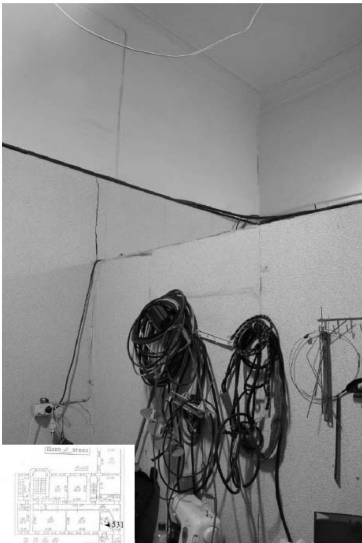
531. Этаж 2, помещение 16-Н. Интерьер комнаты 16,6 кв.м.
