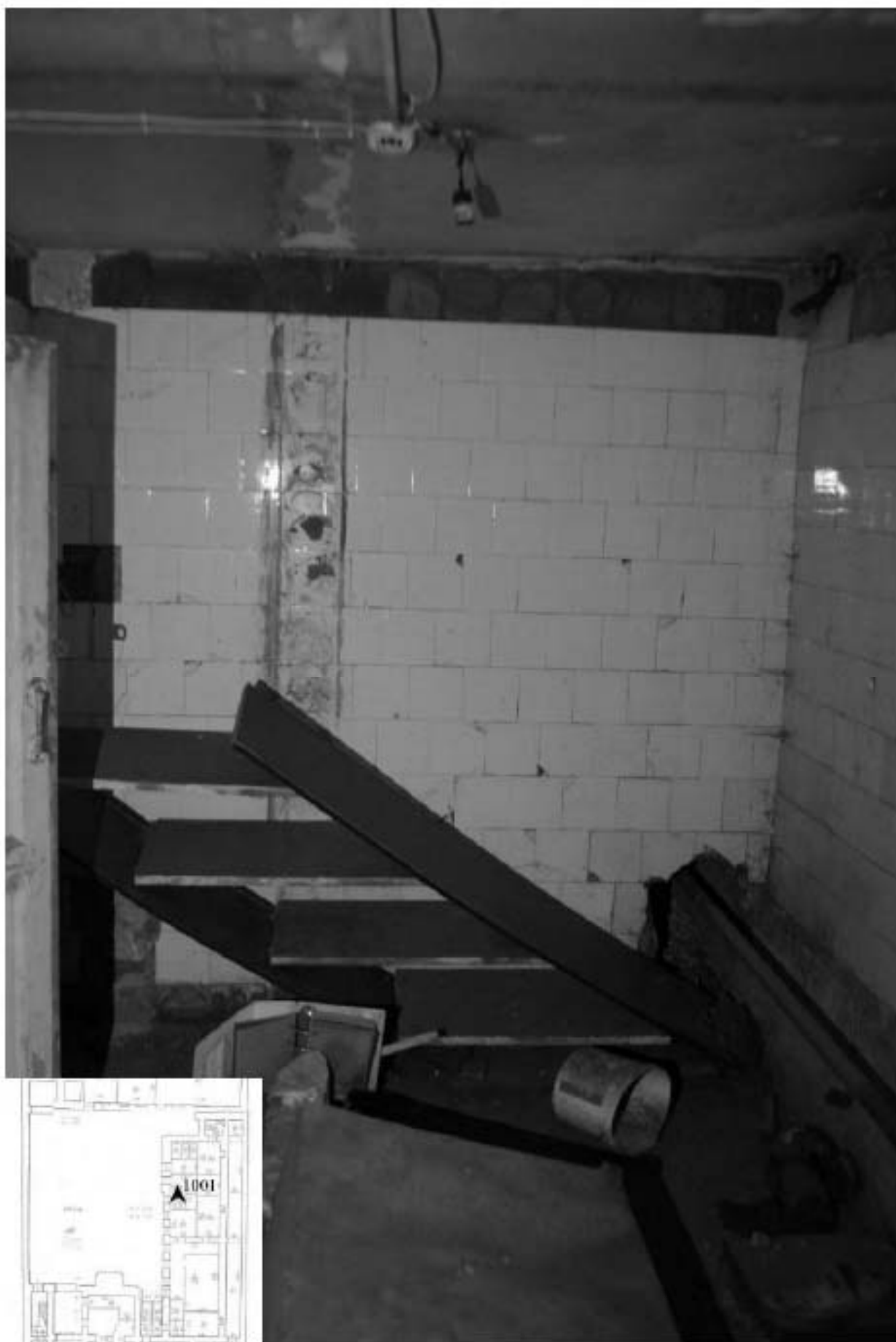
1001. Подвал, помещение 6-Н. Интерьер комнаты 9,4 кв.м.
