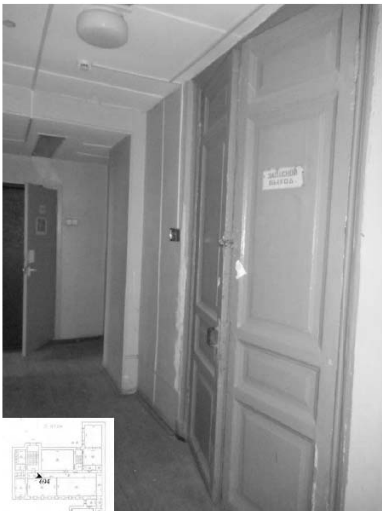
694. Этаж 3, помещение 17-Н. Дверь на лестницу ЗЛК.
