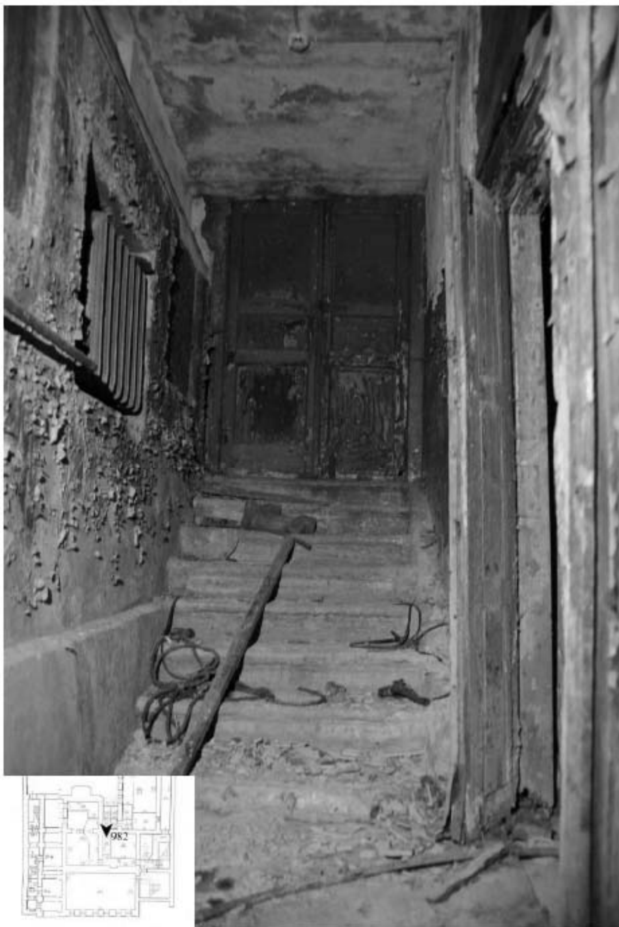
982. Подвал, помещение 6-Н. Вид на лестницу во двор.
