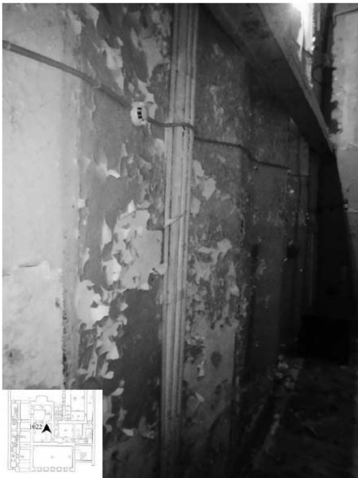
1022. Подвал, помещение 6-Н. Интерьер комнаты 57,8 кв.м.
