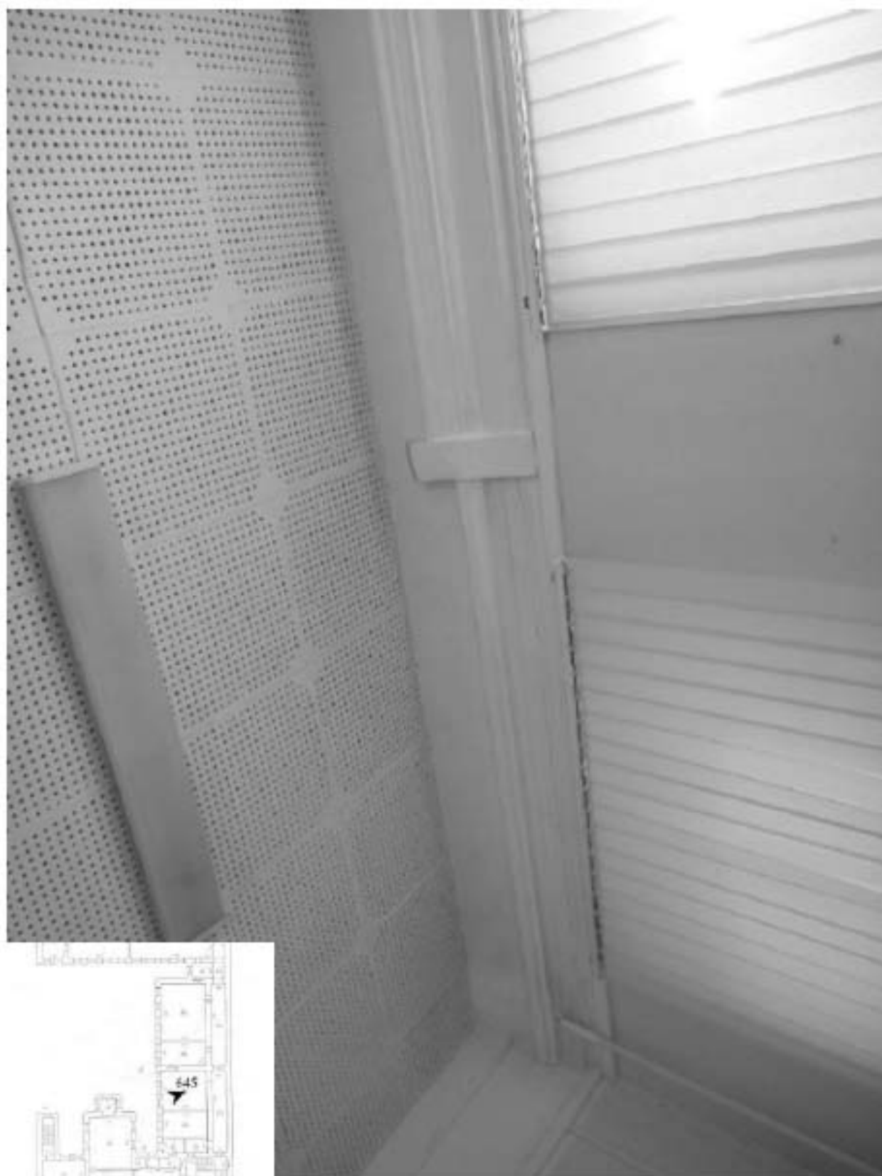
645. Этаж 3, помещение 17-Н. Интерьер комнаты 39,5 кв.м.
