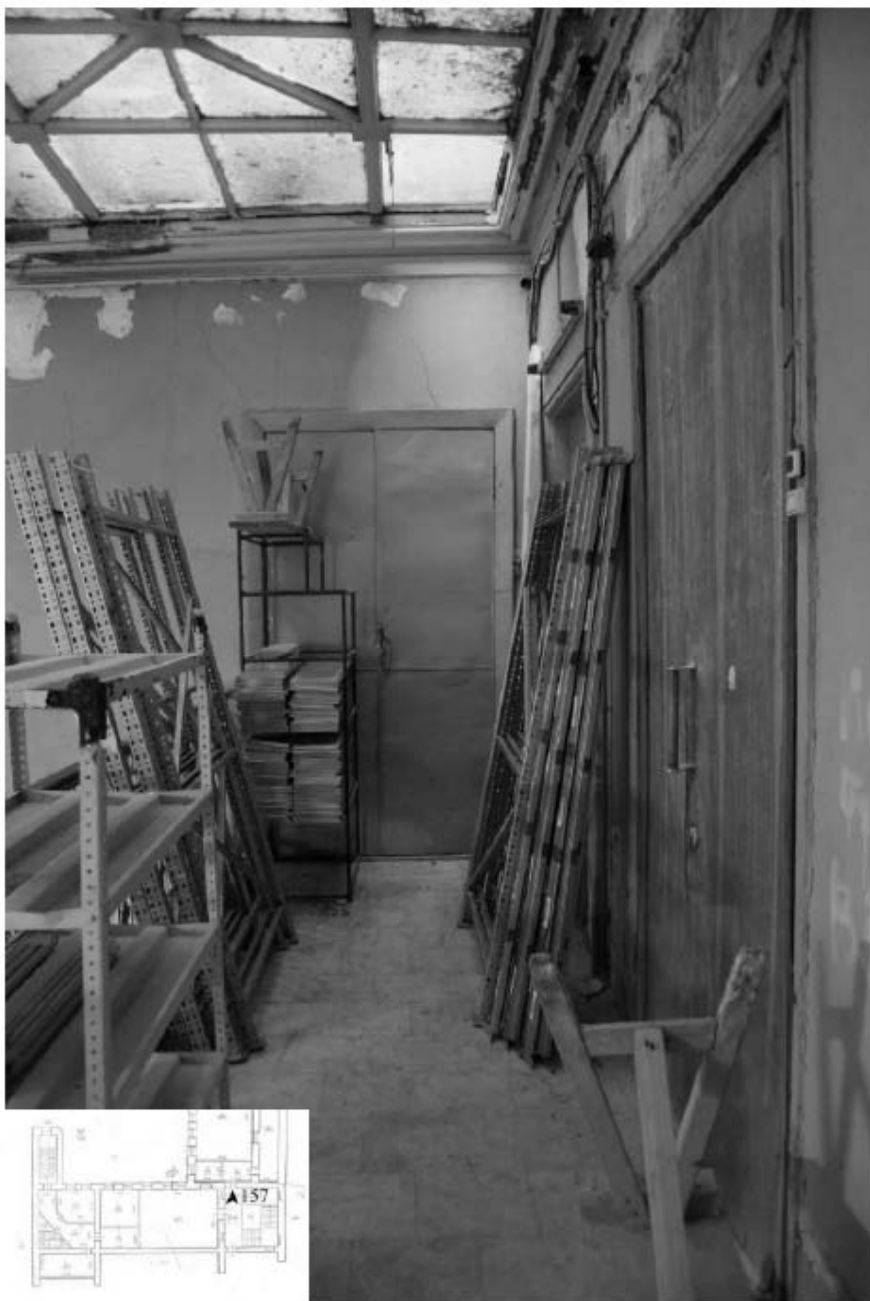
157. Лестничная площадка 5 этажа.
