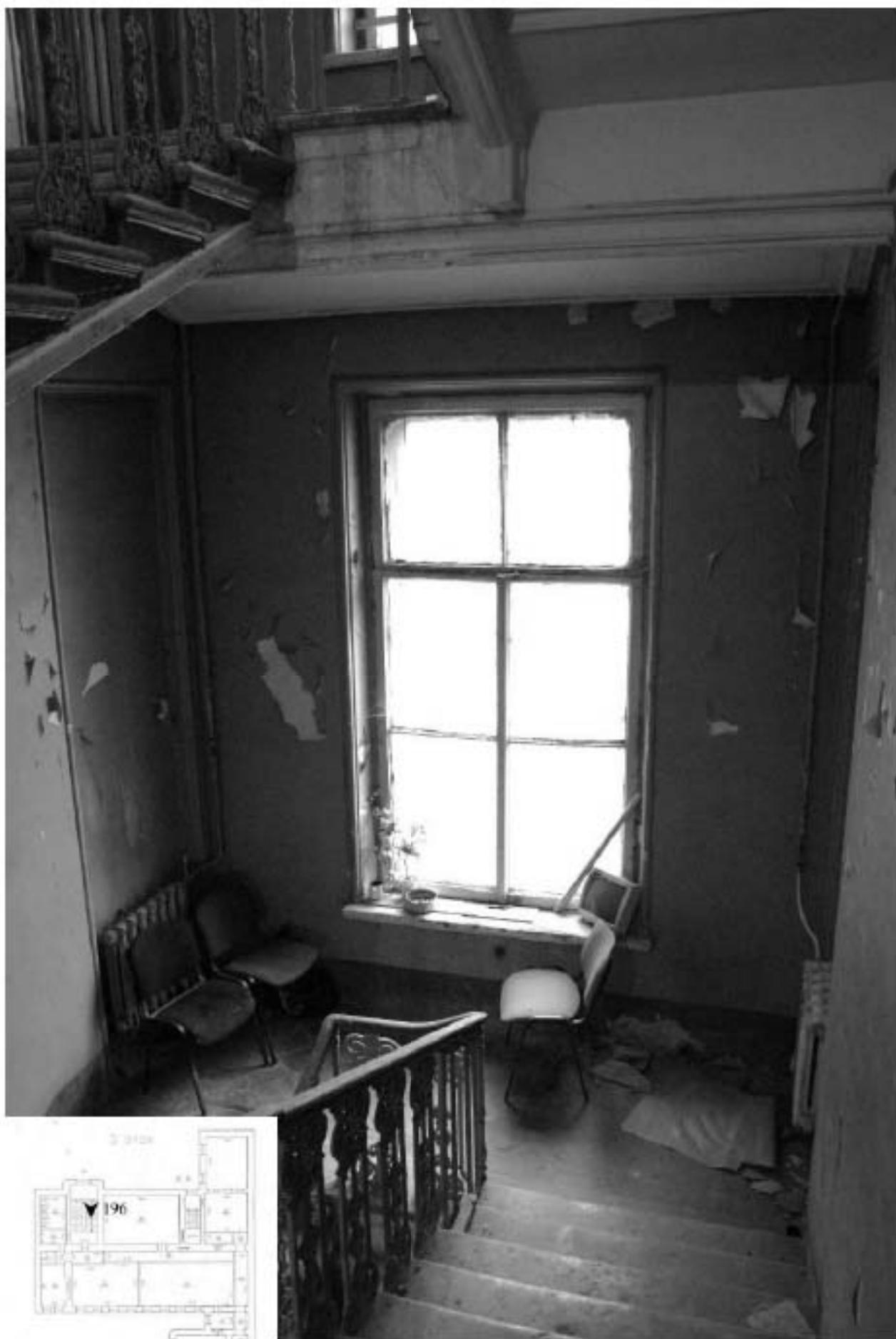
196. Лестница ЗЛК. Вид лестничной площадки между 2 и 3 этажом.
