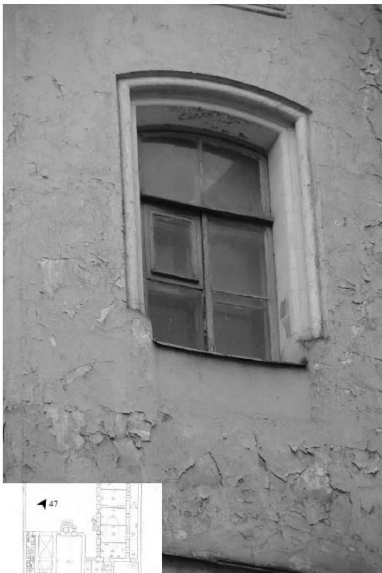
47. Фрагмент дворового фасада лицевого корпуса.
