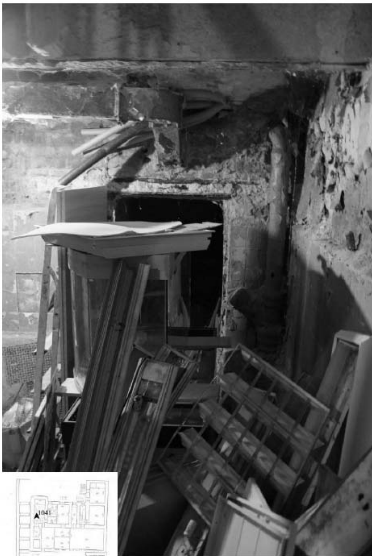
1041. Подвал. Вход в помещение 5-Н.
