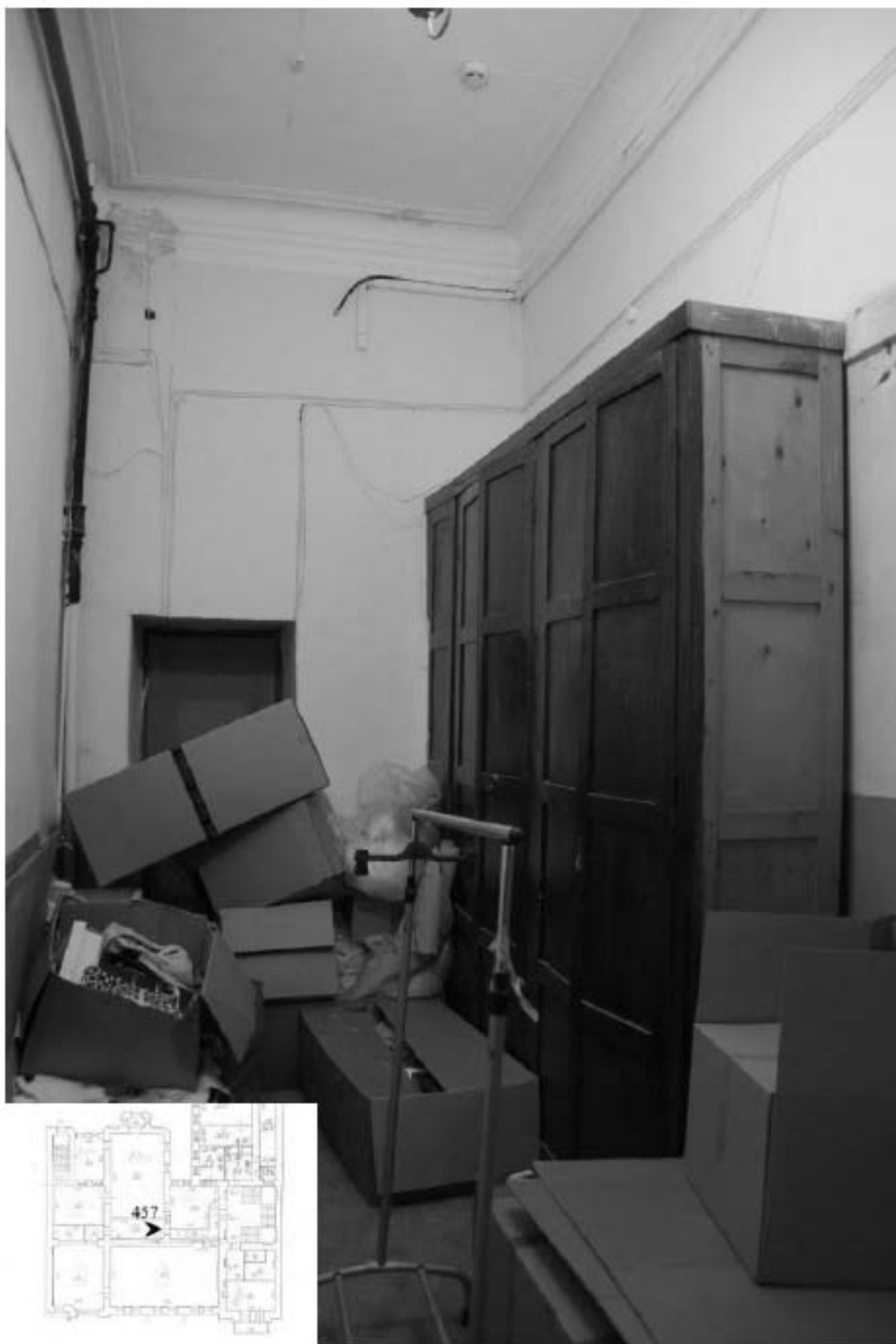
457. Этаж 2, помещение 26-Н. Интерьер комнаты 14,4 кв.м.
