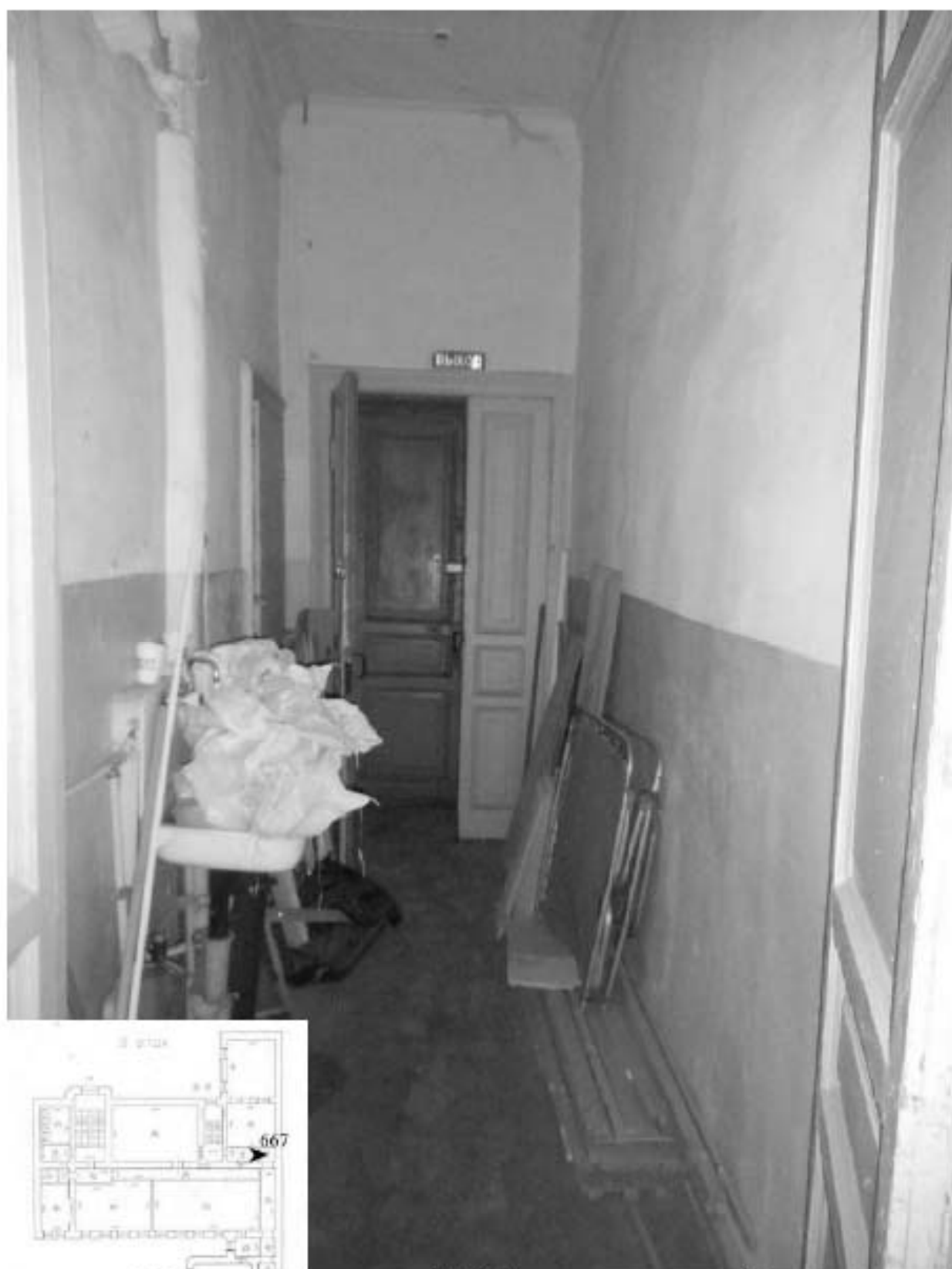
667. Этаж 3, помещение 17-Н. Интерьер комнаты 4,8 кв.м.
