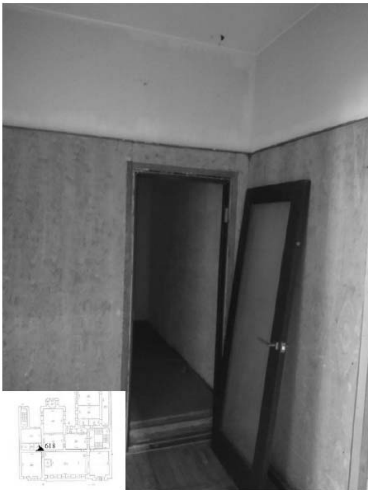
618. Этаж 3, помещение 37-Н. Интерьер комнаты 4,9 кв.м.
