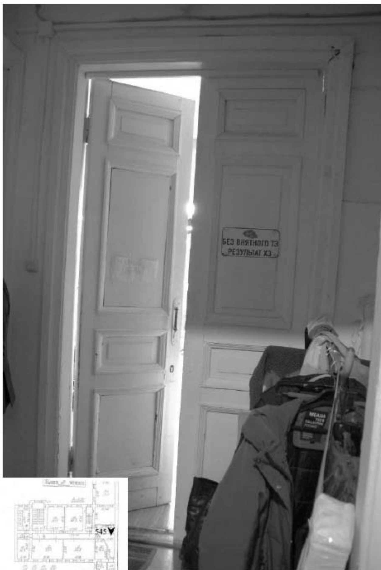
545. Этаж 2, помещение 16-Н. Дверь комнаты 23.
