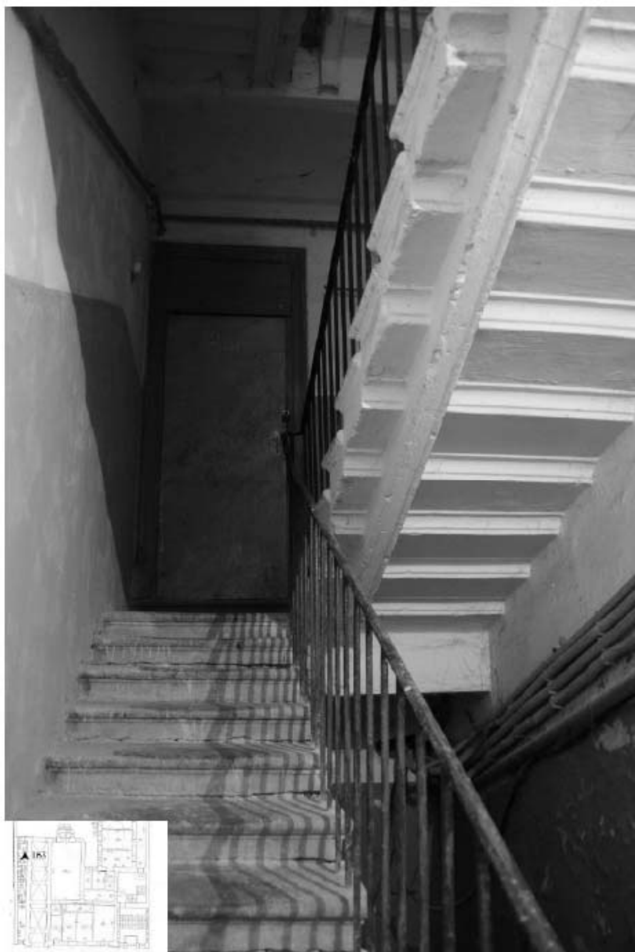
163. Лестница 2ЛК. Вид на лестничную площадку 1 этажа.
