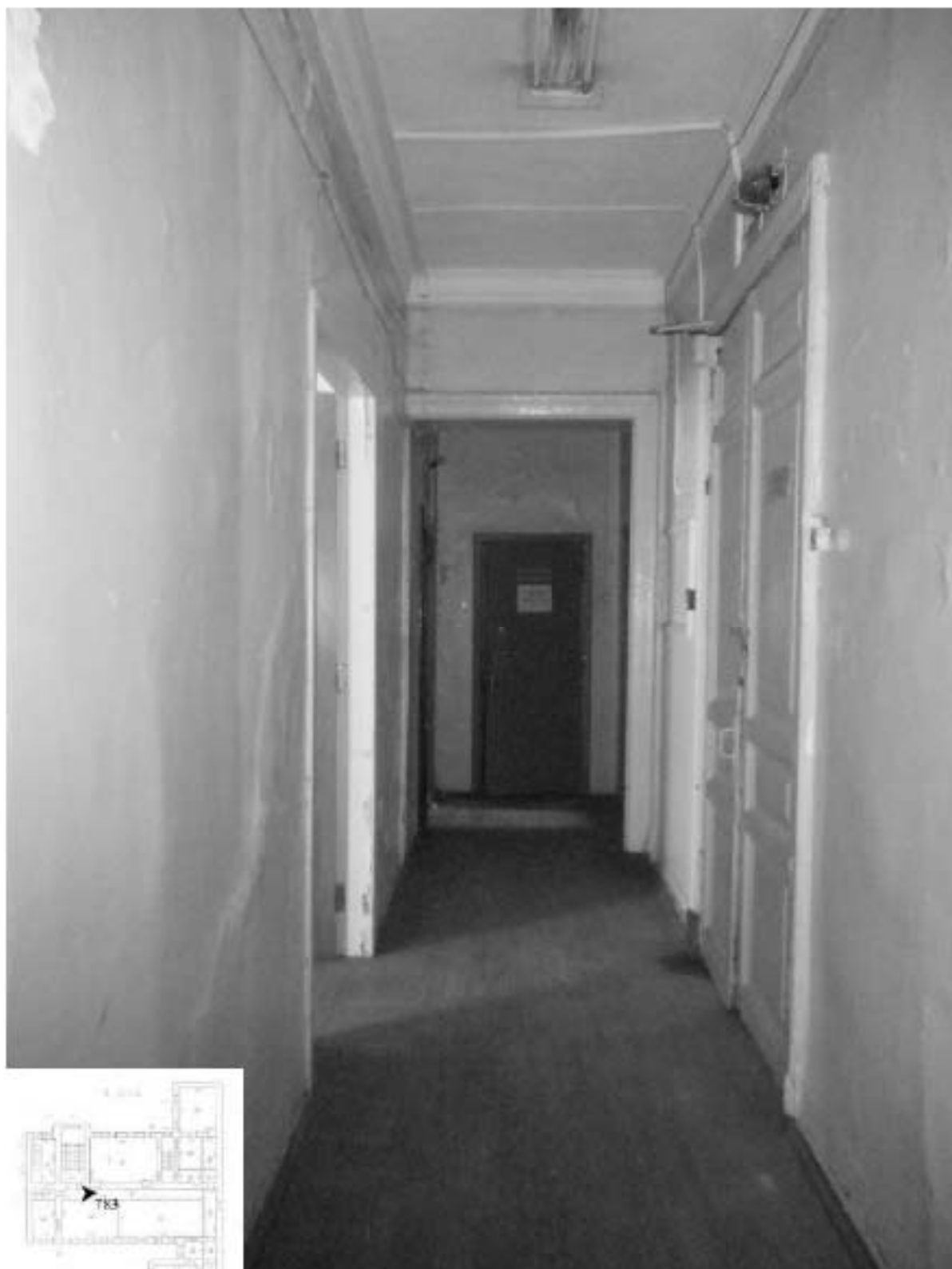
783. Этаж 4, помещение 40-Н. Вид коридора.
