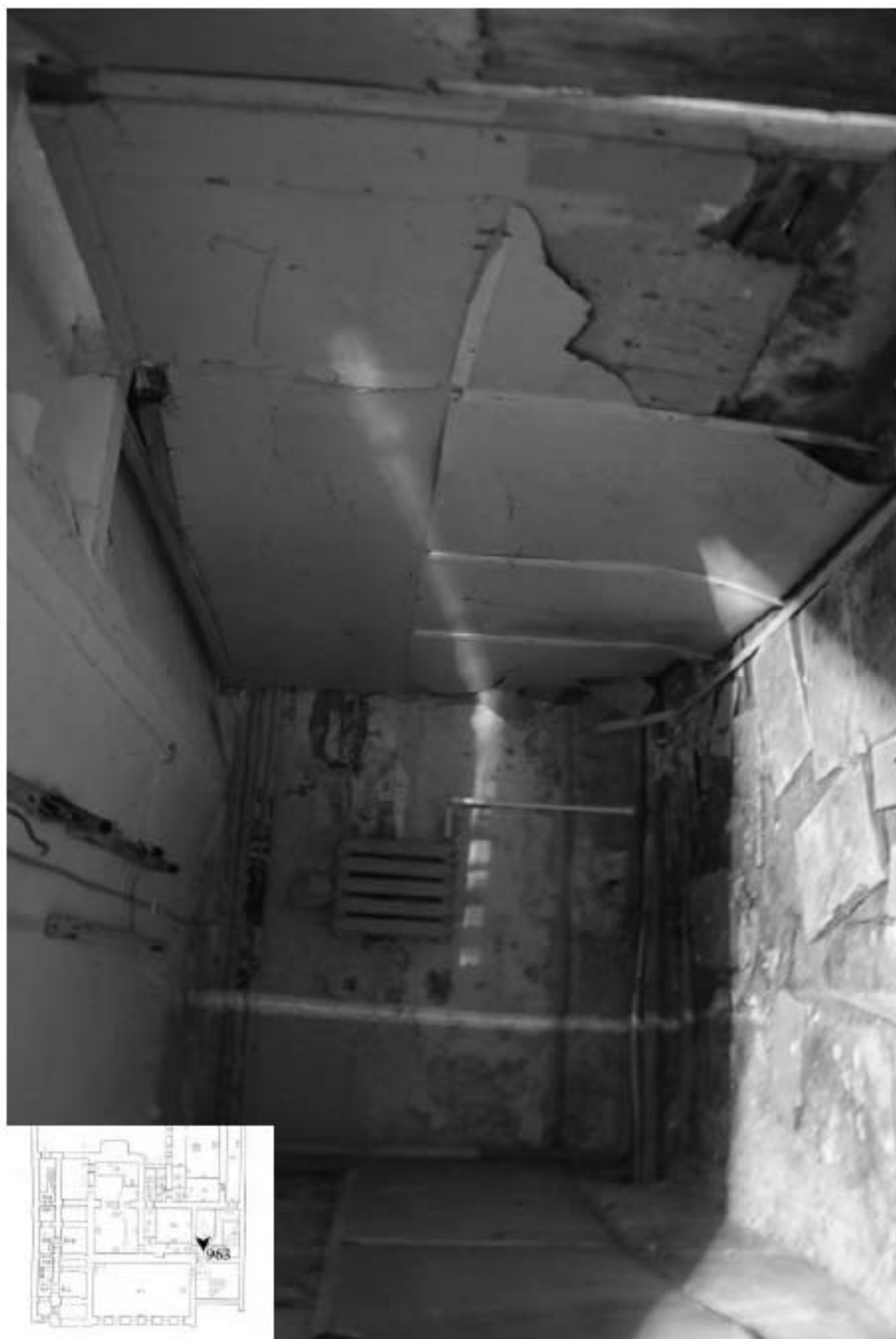
963. Подвал. Интерьер комнаты 11,2 кв.м.
