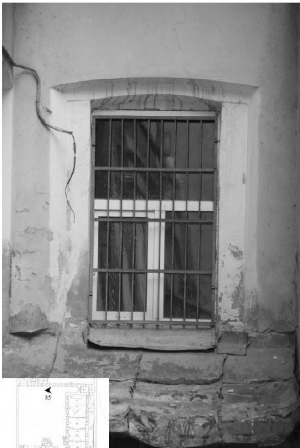
85. Фрагмент дворового фасада.
