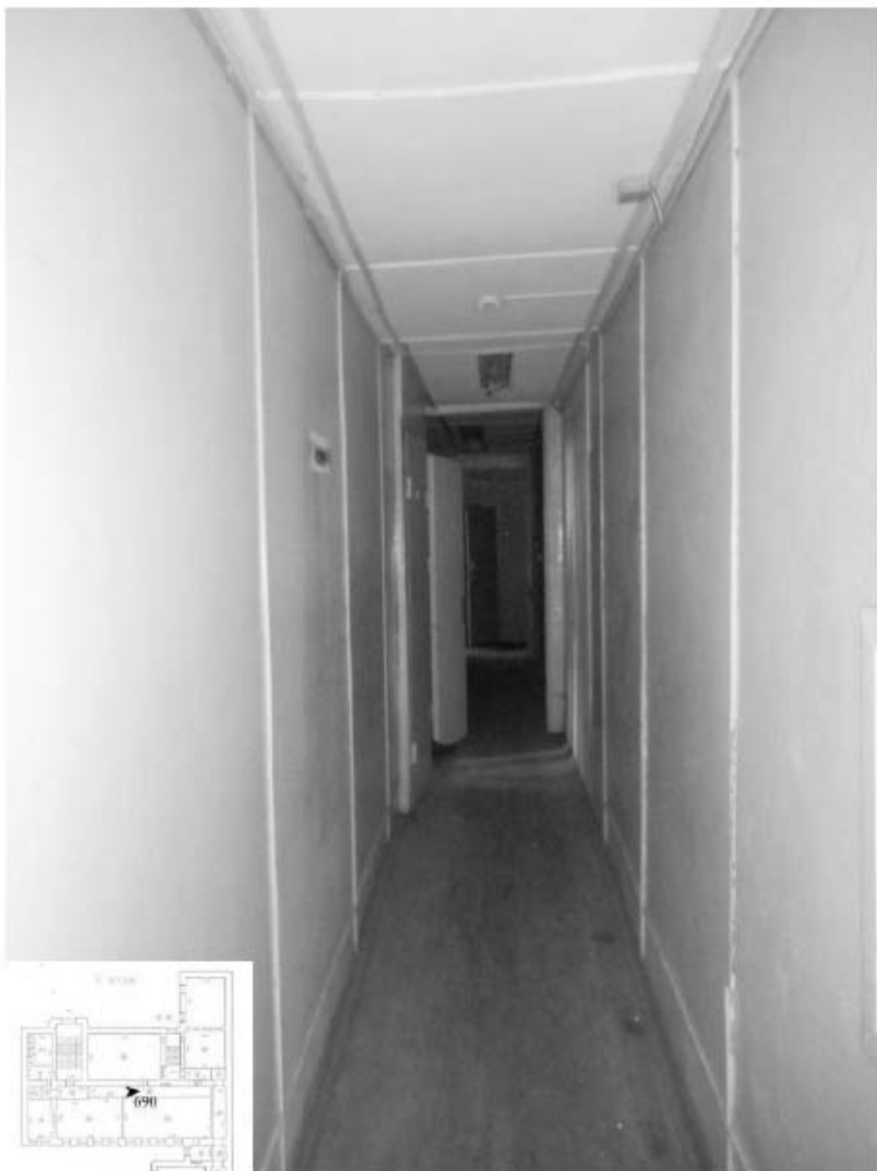
690. Этаж 3, помещение 17-Н. Вид коридора.
