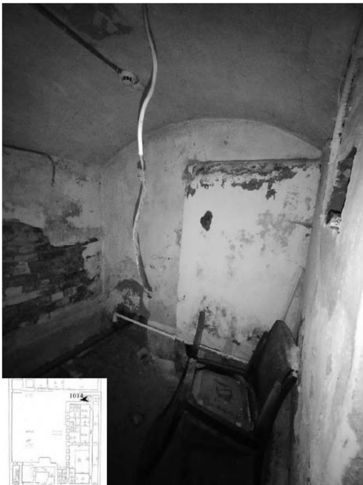
1014. Подвал, помещение 6-Н. Интерьер комнаты 4,3 кв.м.
