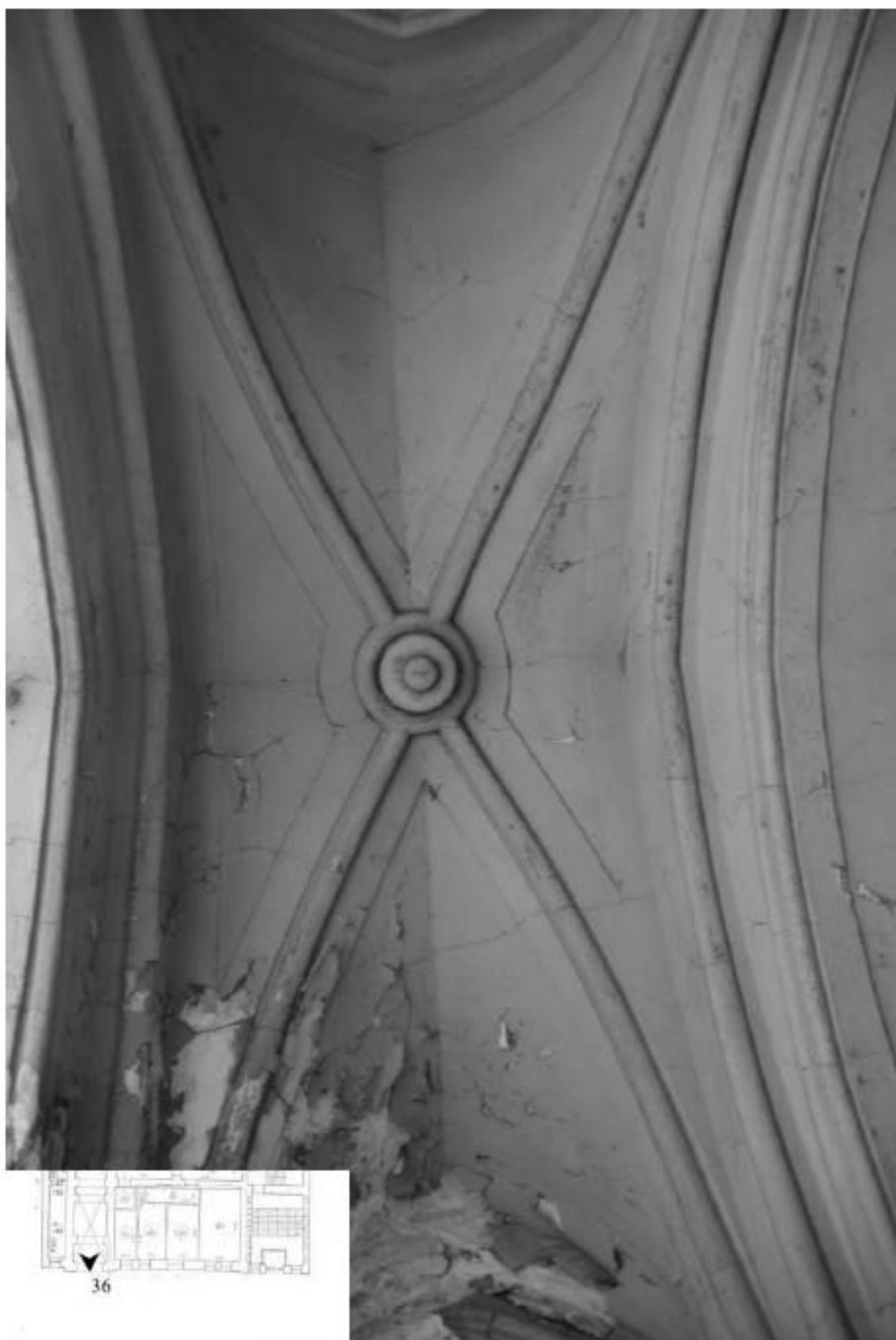
36. Вид на свод проездной арки.
