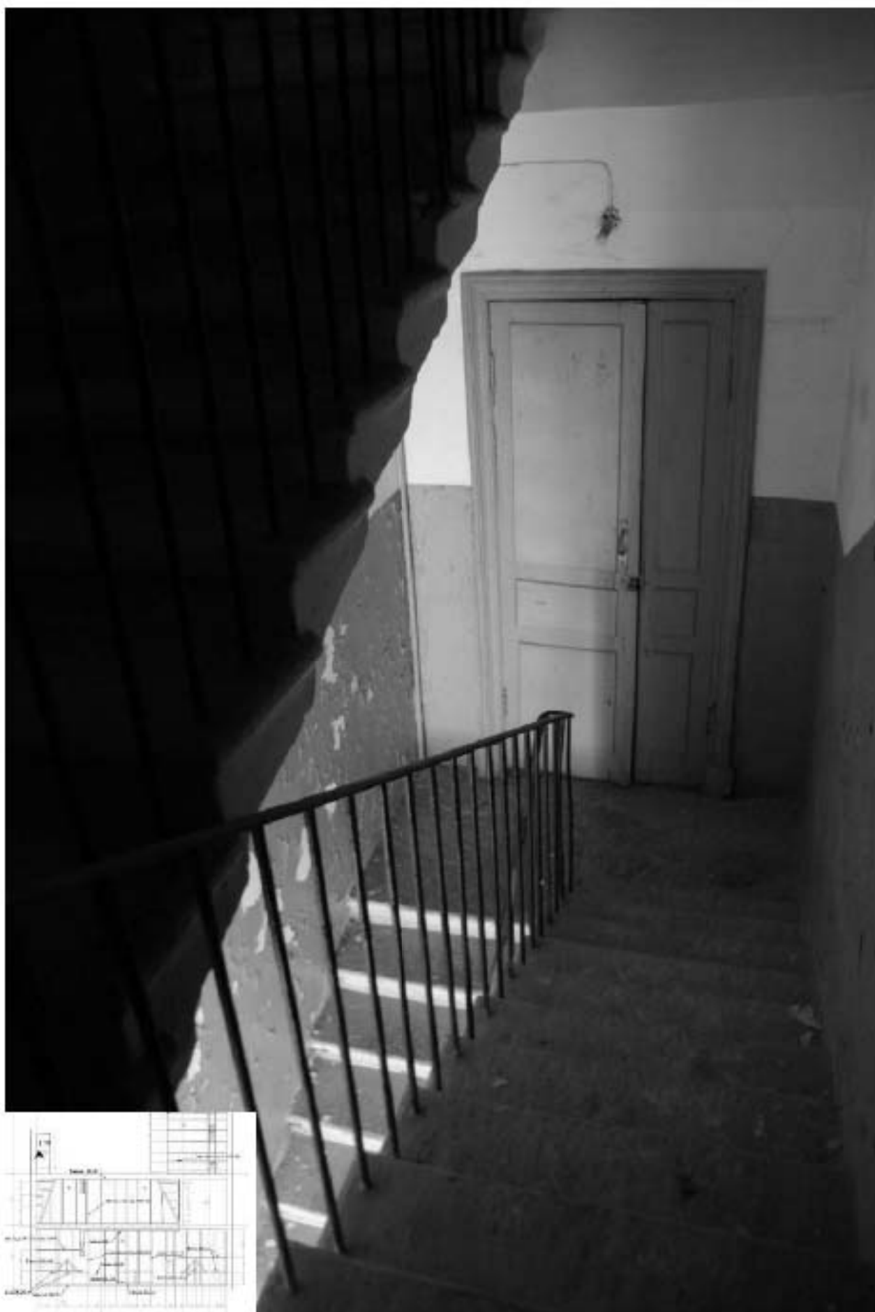
179. Лестница 2ЛК. Вид на лестничную площадку 5 этажа.
