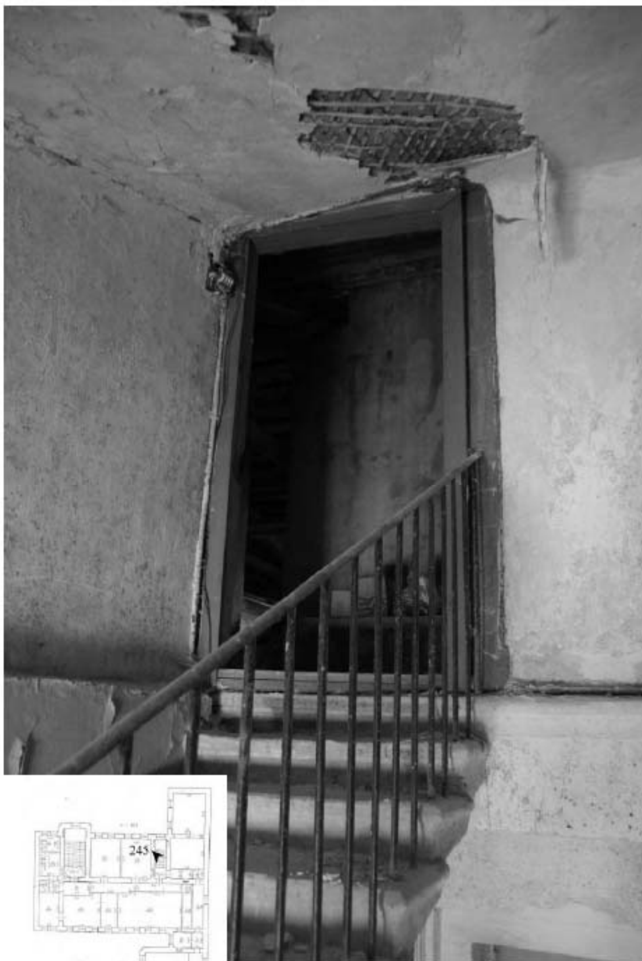
245. Лестница 4ЛК. Выход на чердак.
