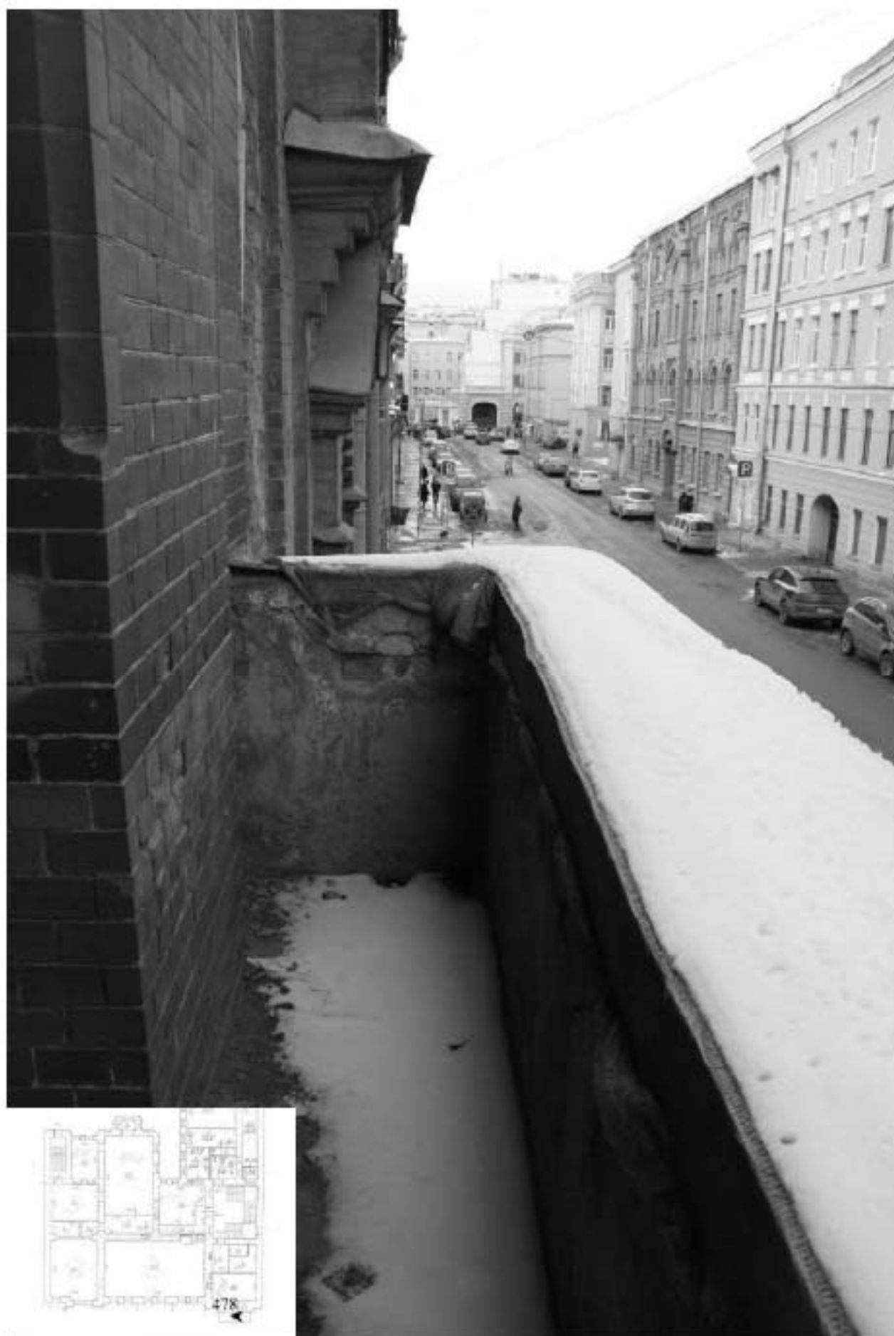
478. Этаж 2, помещение 30-Н. Балкон.
