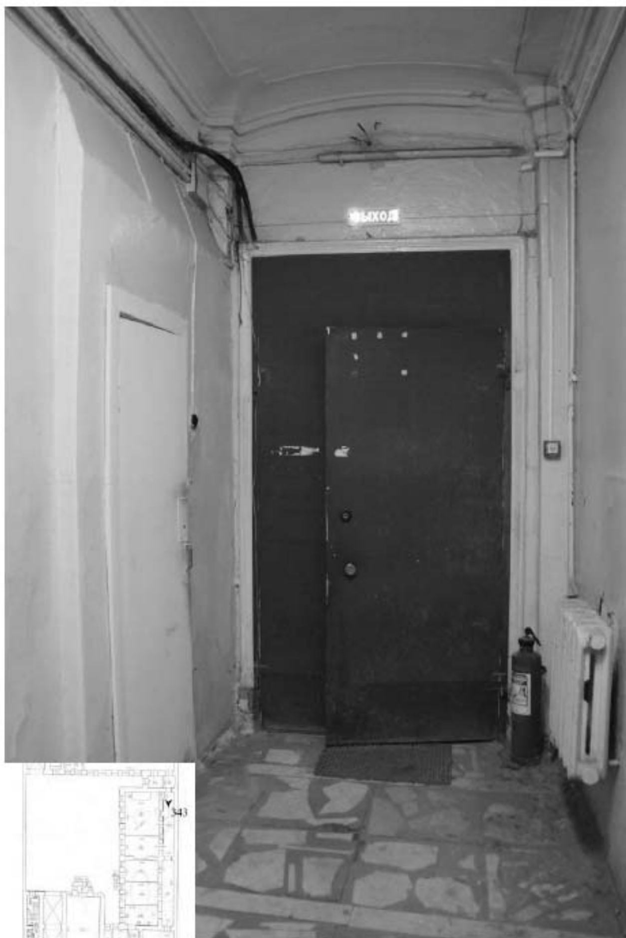
343. Этаж 1, помещение 15-Н. Вид коридора.
