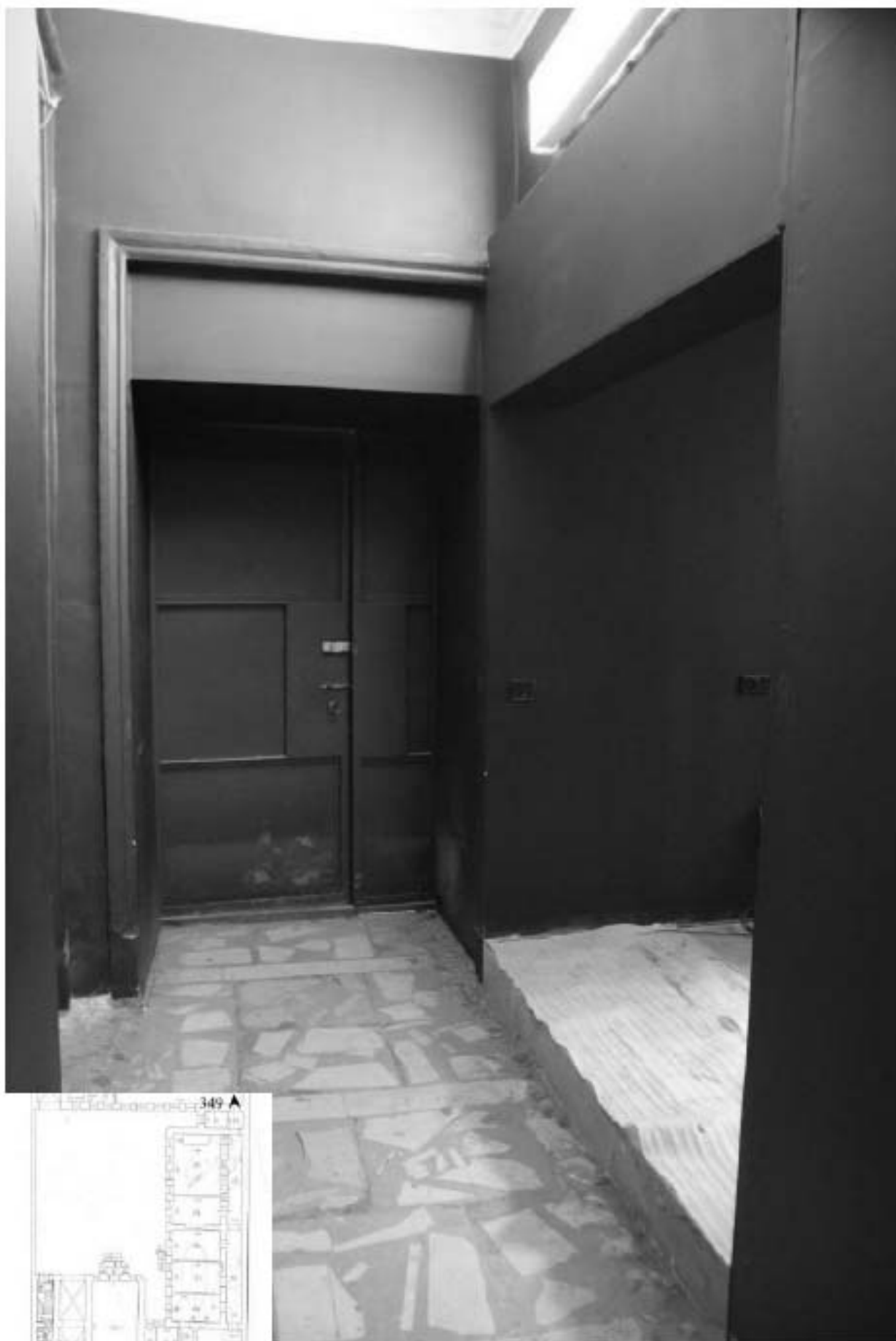
349. Этаж 1, помещение 15-Н. Интерьер комнаты 3,7 кв.м.
