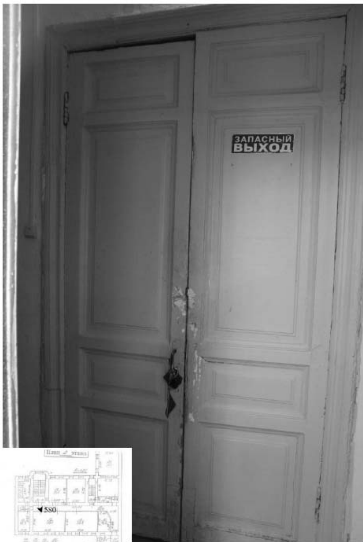
580. Этаж 2, помещение 16-Н. Дверь на лестницу ЗЛК.
