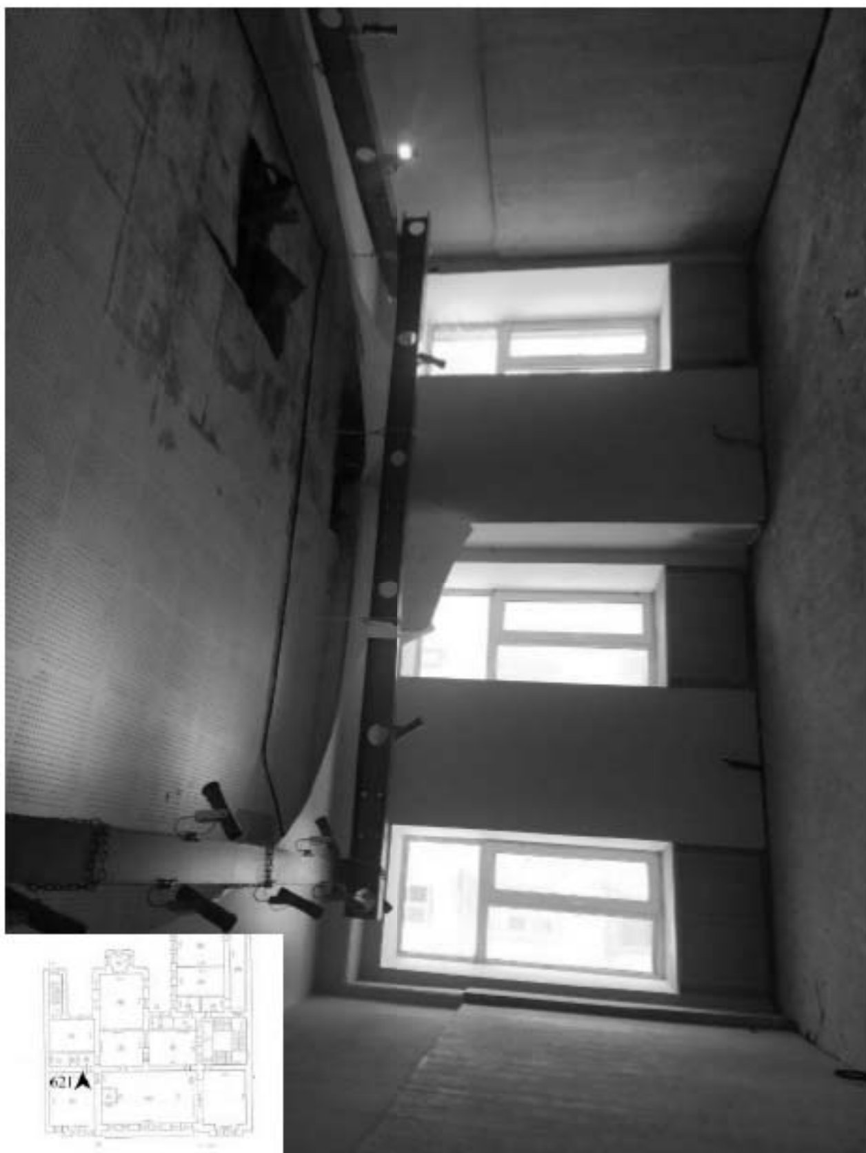
621. Этаж 3, помещение 37-Н. Интерьер комнаты 48,9 кв.м.
