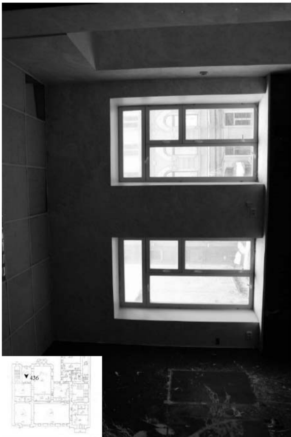
436. Этаж 2, помещение 26-Н. Интерьер комнаты 20,1 кв.м.
