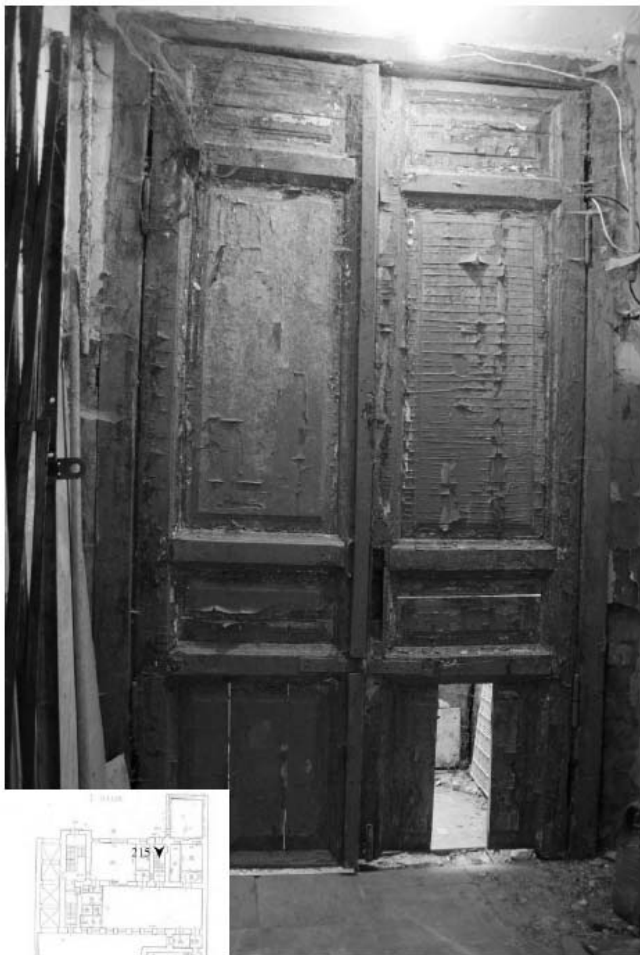
215. Лестница 4ЛК. Входная дверь.
