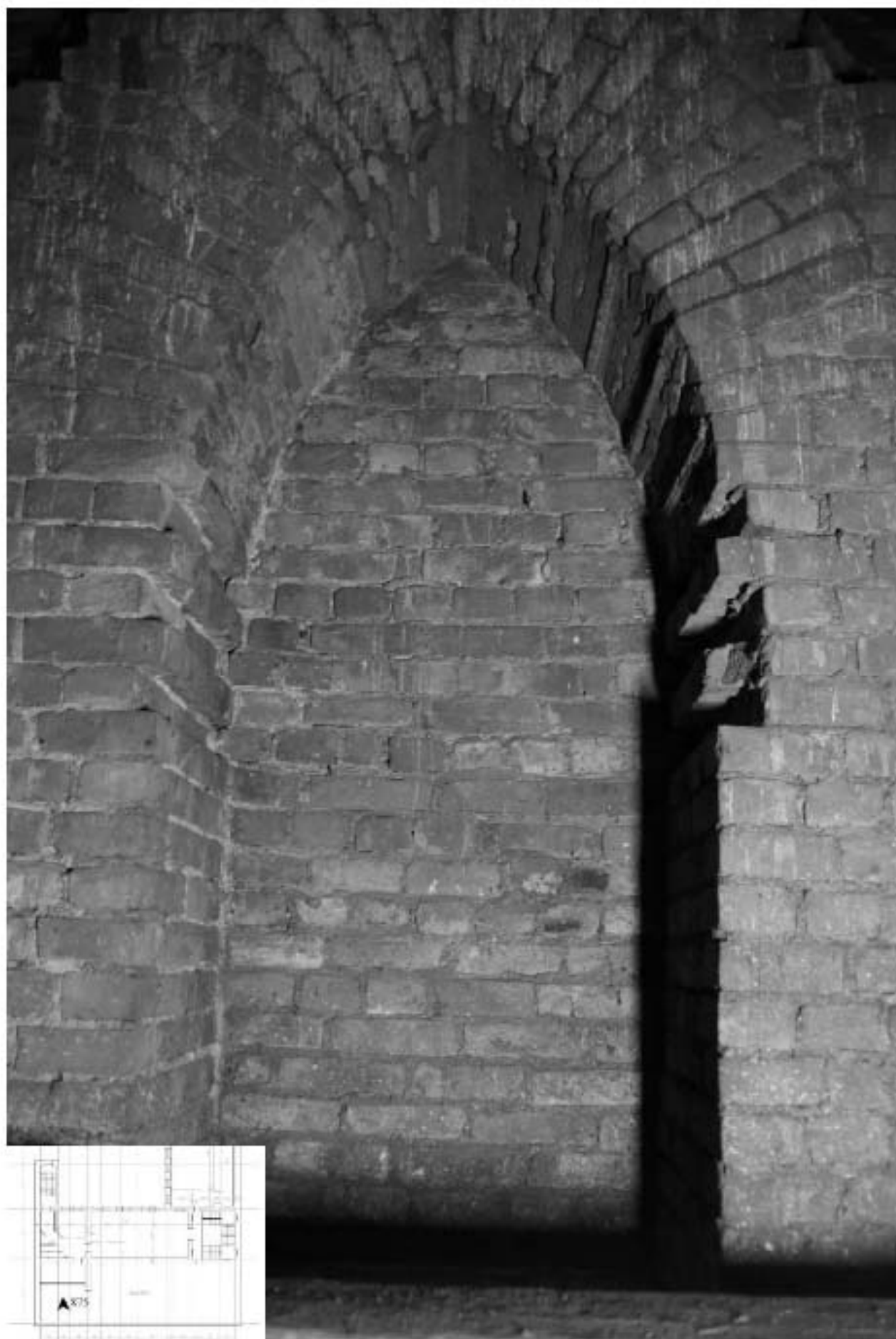
875. Этаж 5, интерьер чердака.
