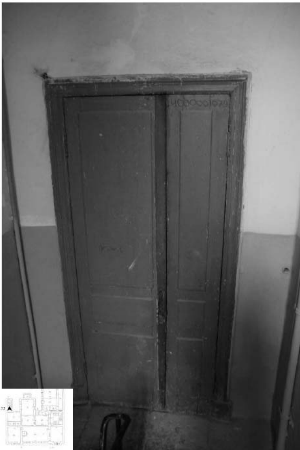
172. Лестница 2ЛК, третий этаж. Вид входной двери в помещение 37-Н.
