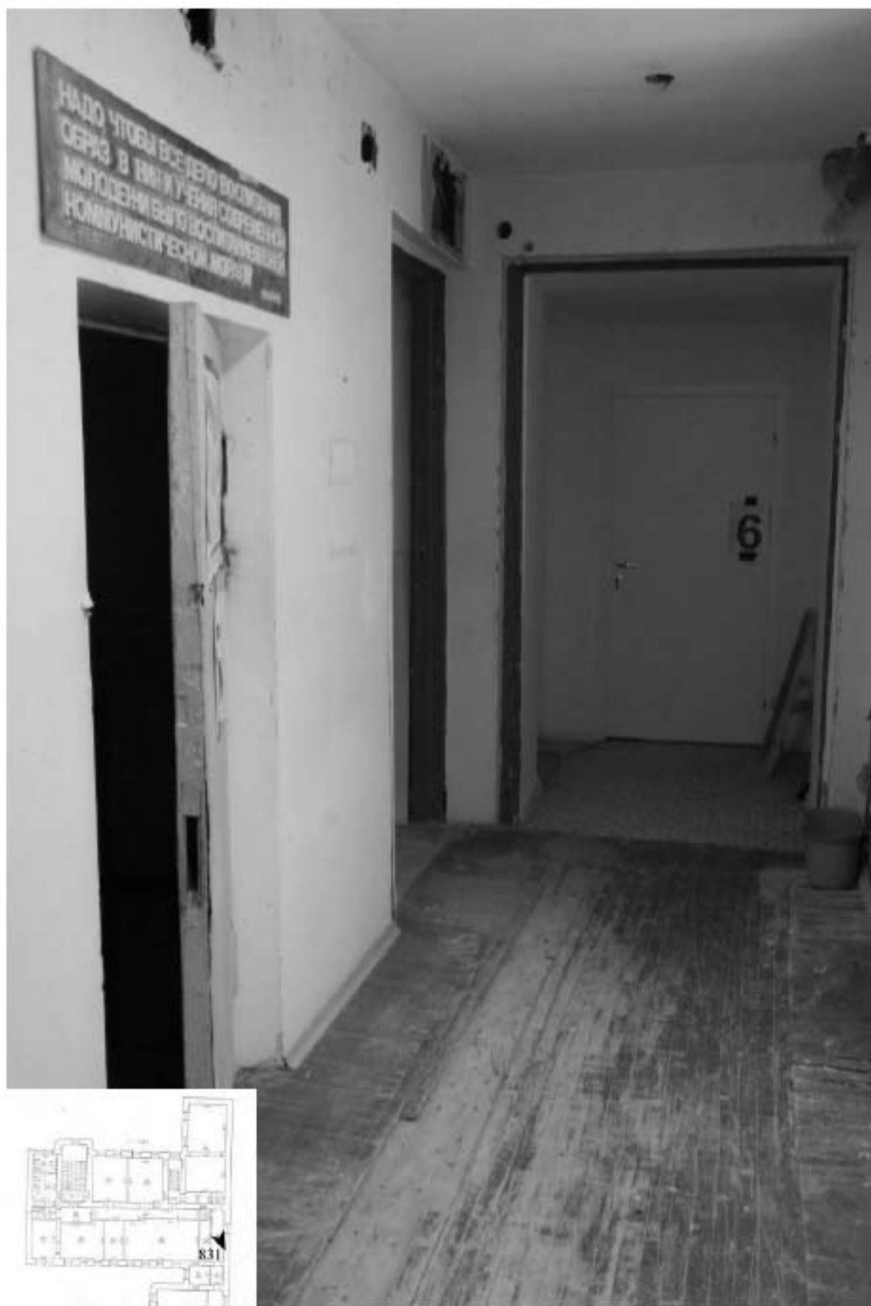
831. Этаж 5, помещение 19-Н. Вид коридора.
