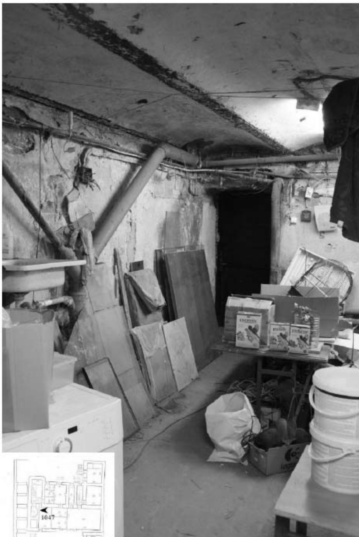
1047. Подвал, помещение 2-Н. Интерьер комнаты 27,9 кв.м.
