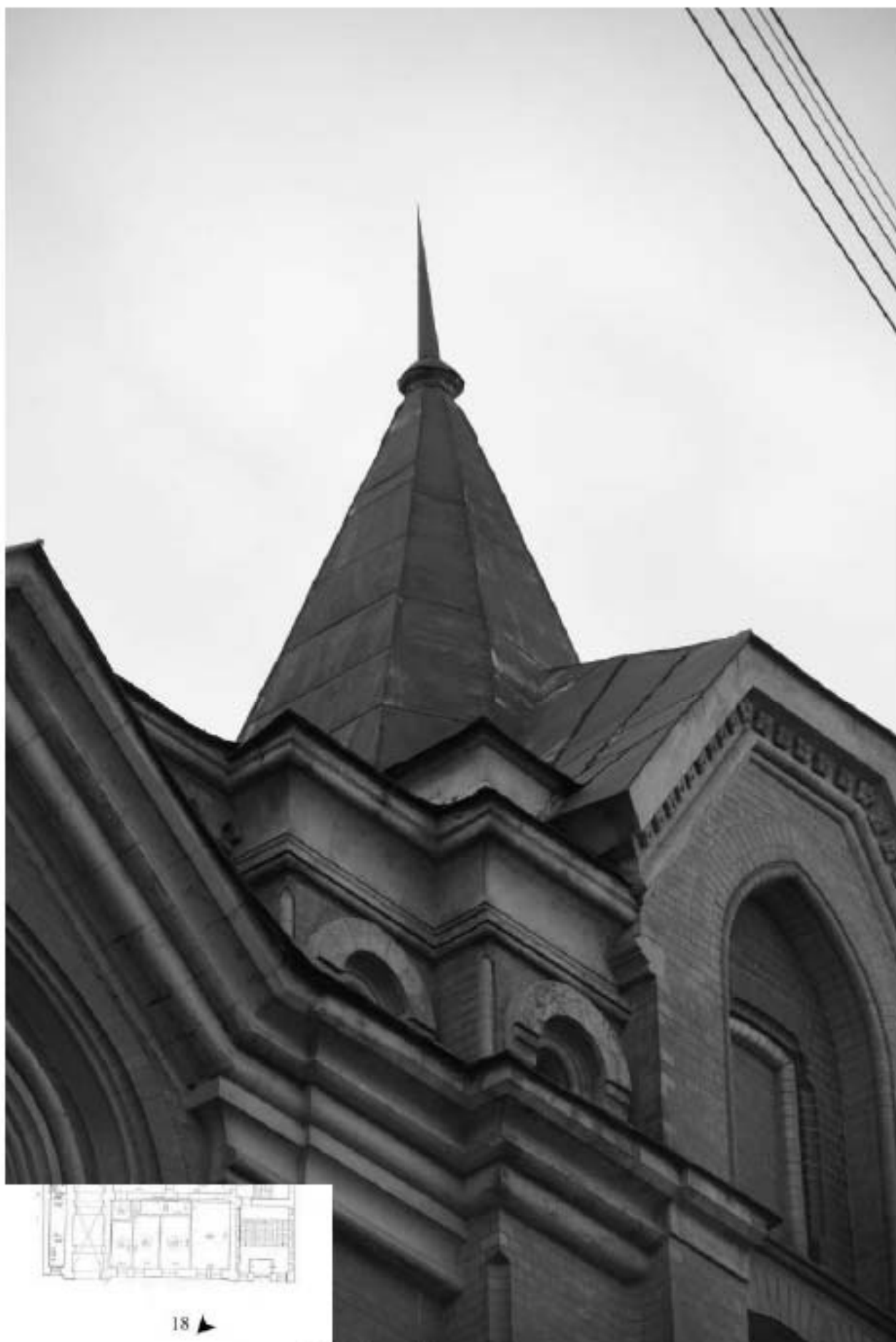
18. Вид на башенку кровли.
