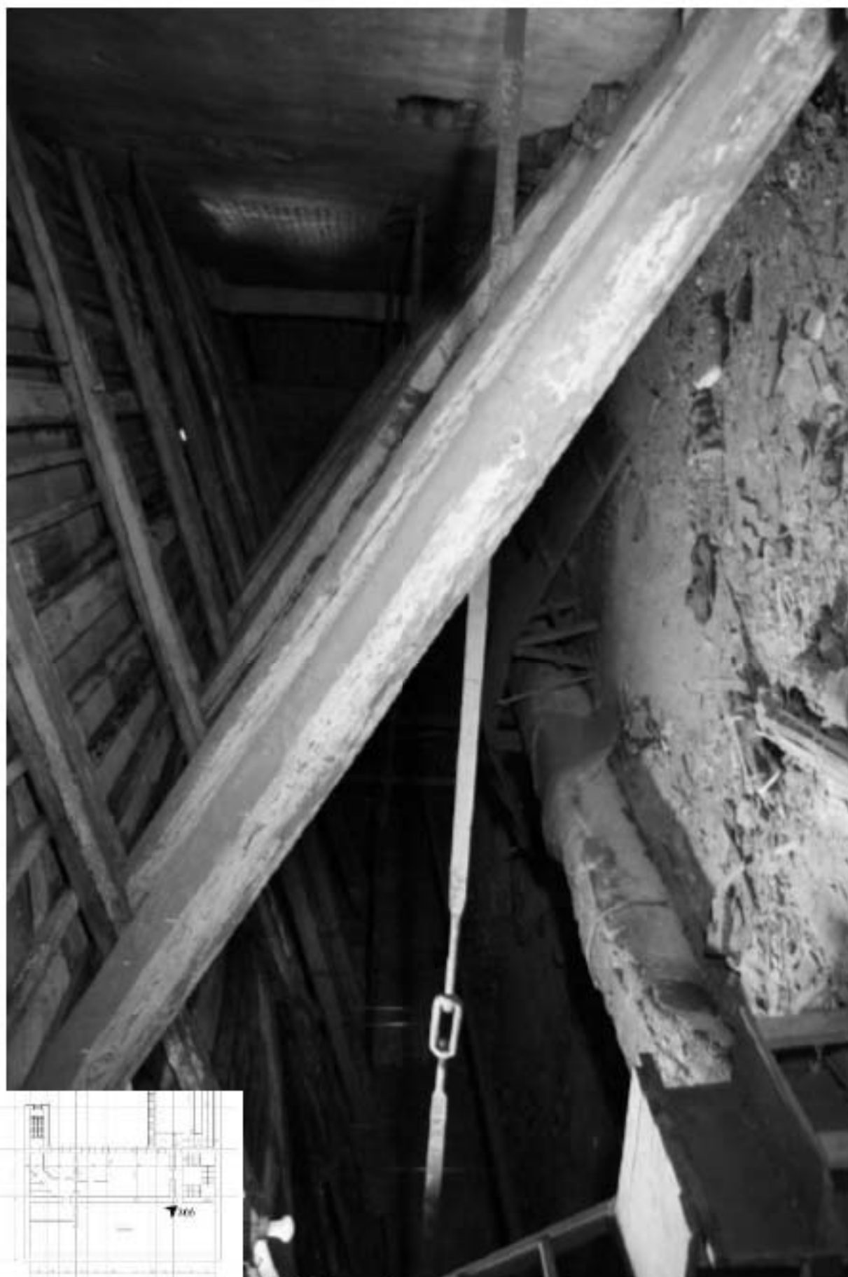
866. Этаж 5, интерьер чердака.
