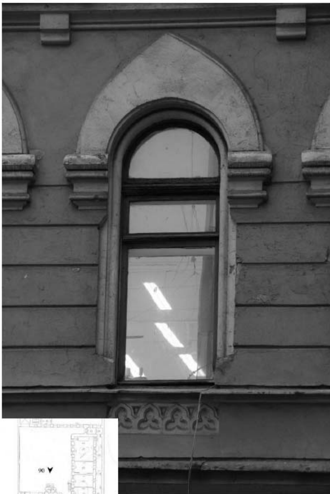
90. Фрагмент дворового фасада.
