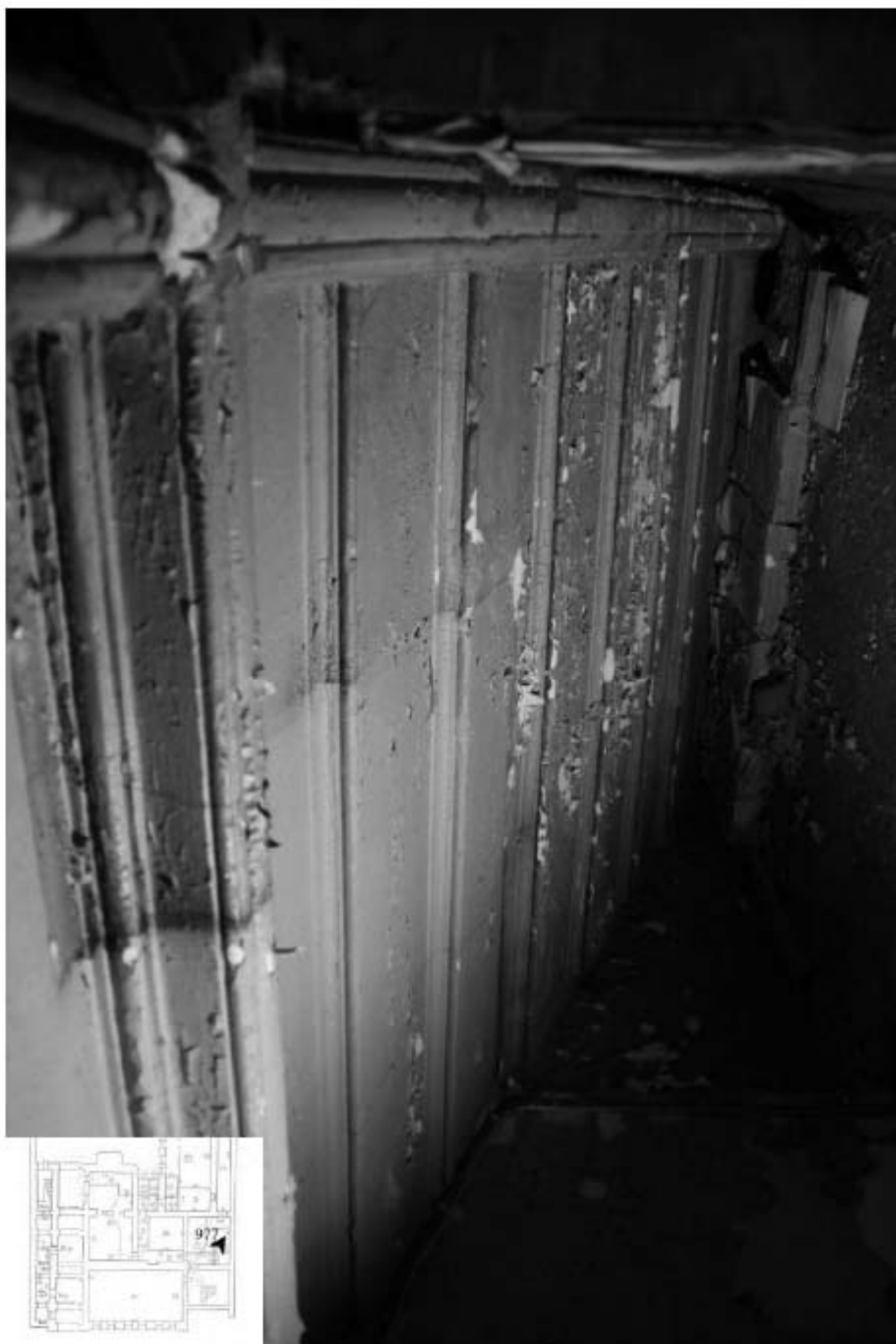
977. Подвал, помещение 6-Н. Лестница на 1 этаж.
