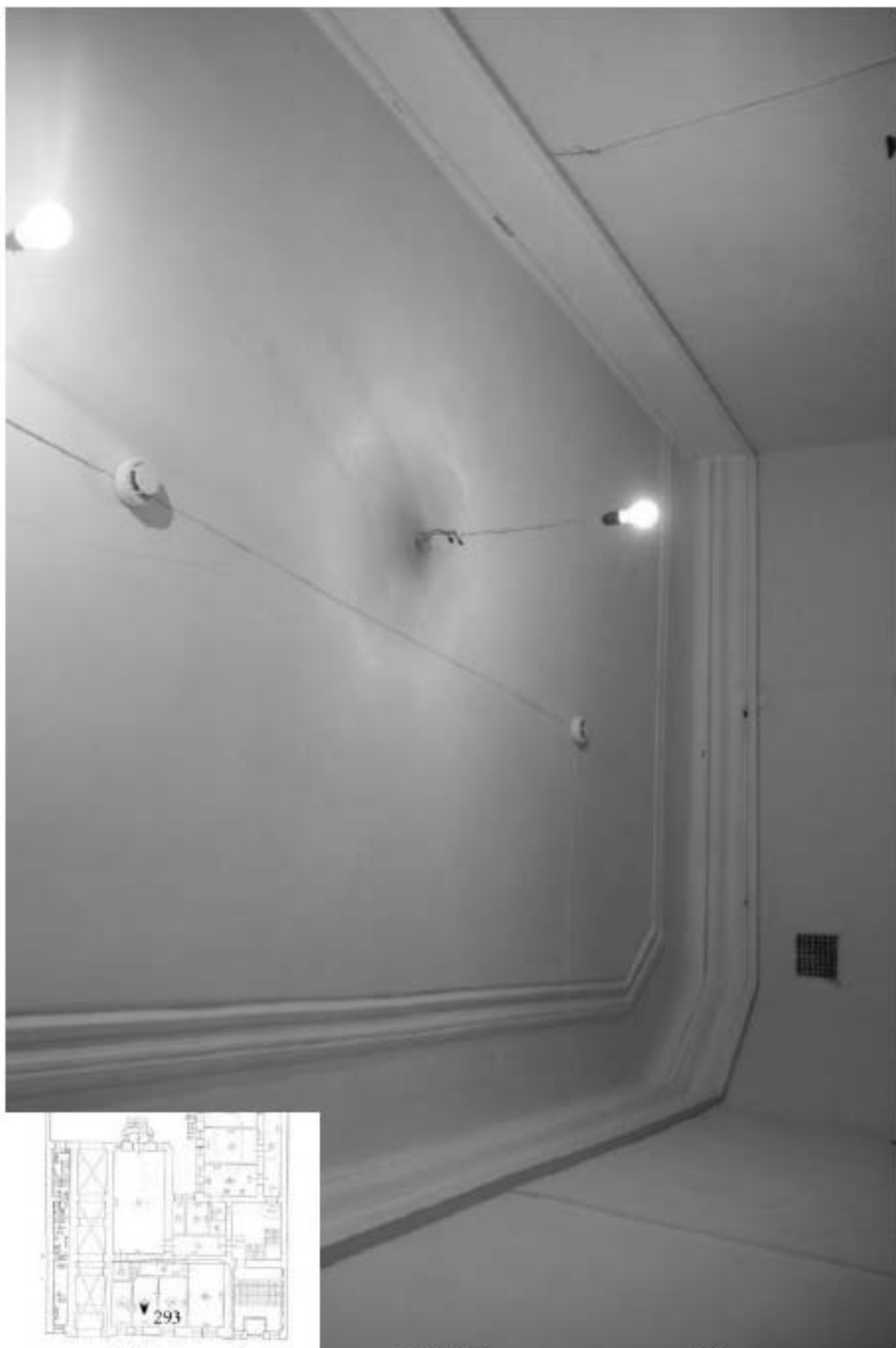
293. Этаж 1, помещение 20-Н. Потолок комнаты 18,0 кв.м.
