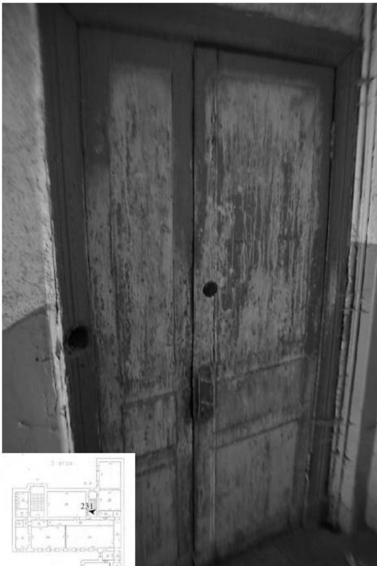
231. Лестница 4ЛК. Дверь лестничной площадки 3 этажа.
