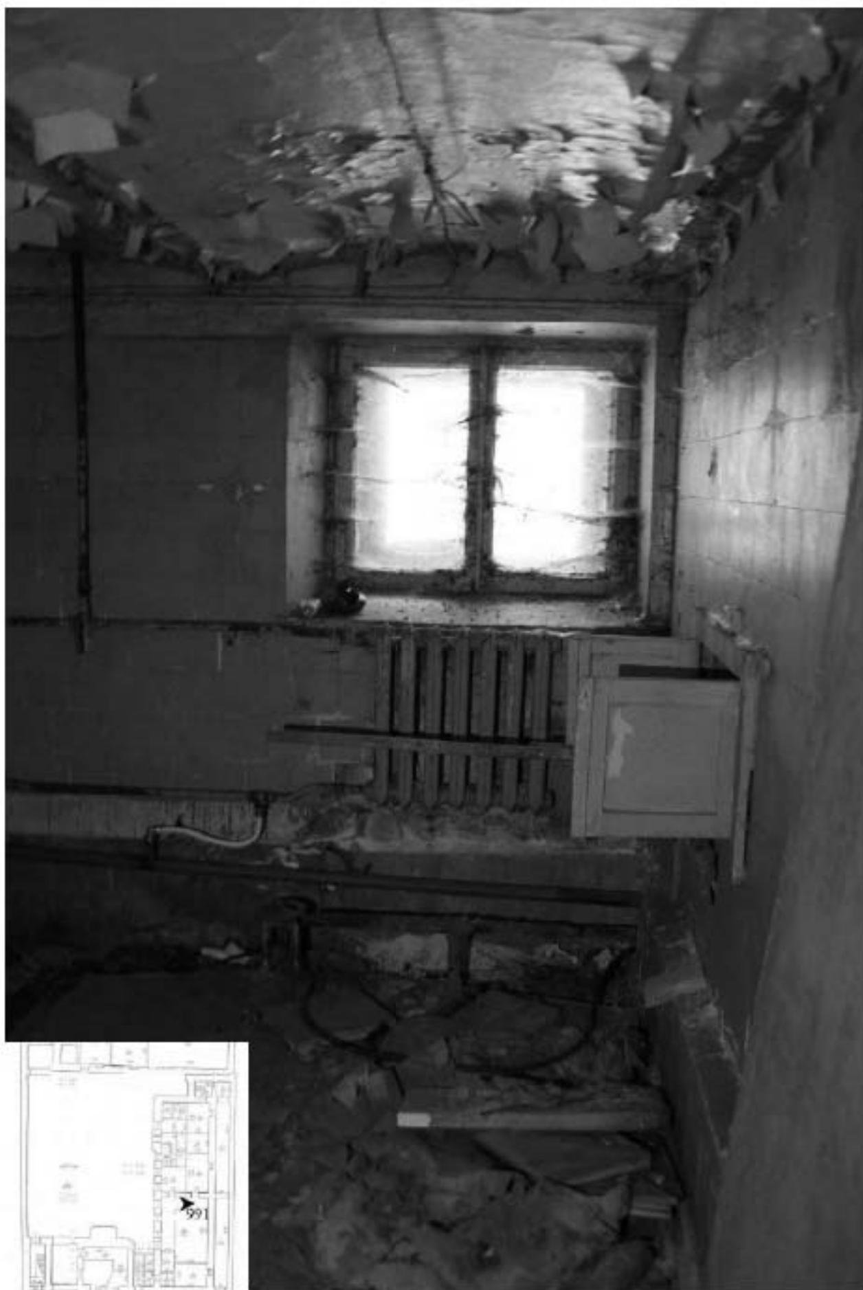
991. Подвал, помещение 6-Н. Вид коридора.
