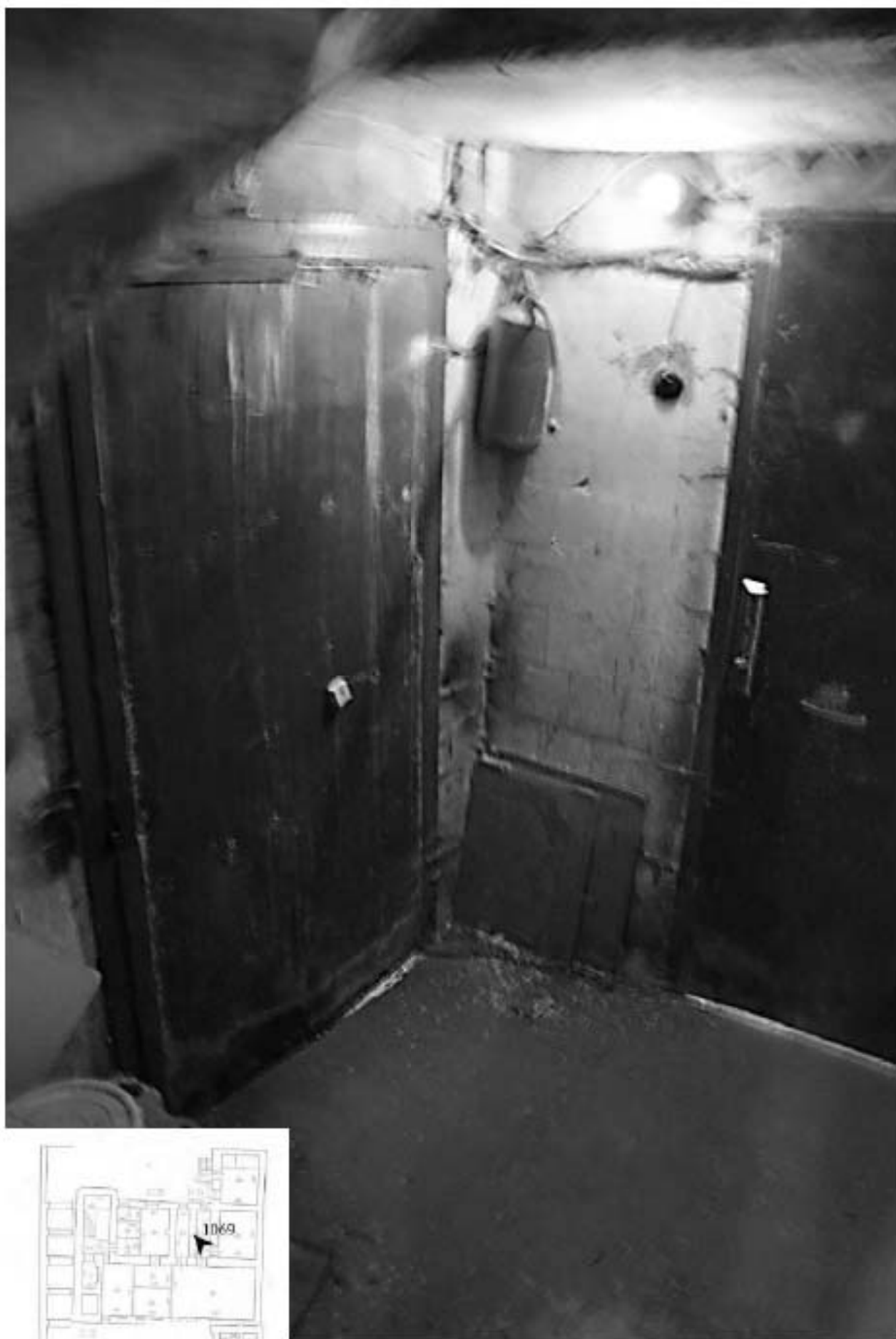
1069. Вход в подвал с лестницы 4ЛК.
