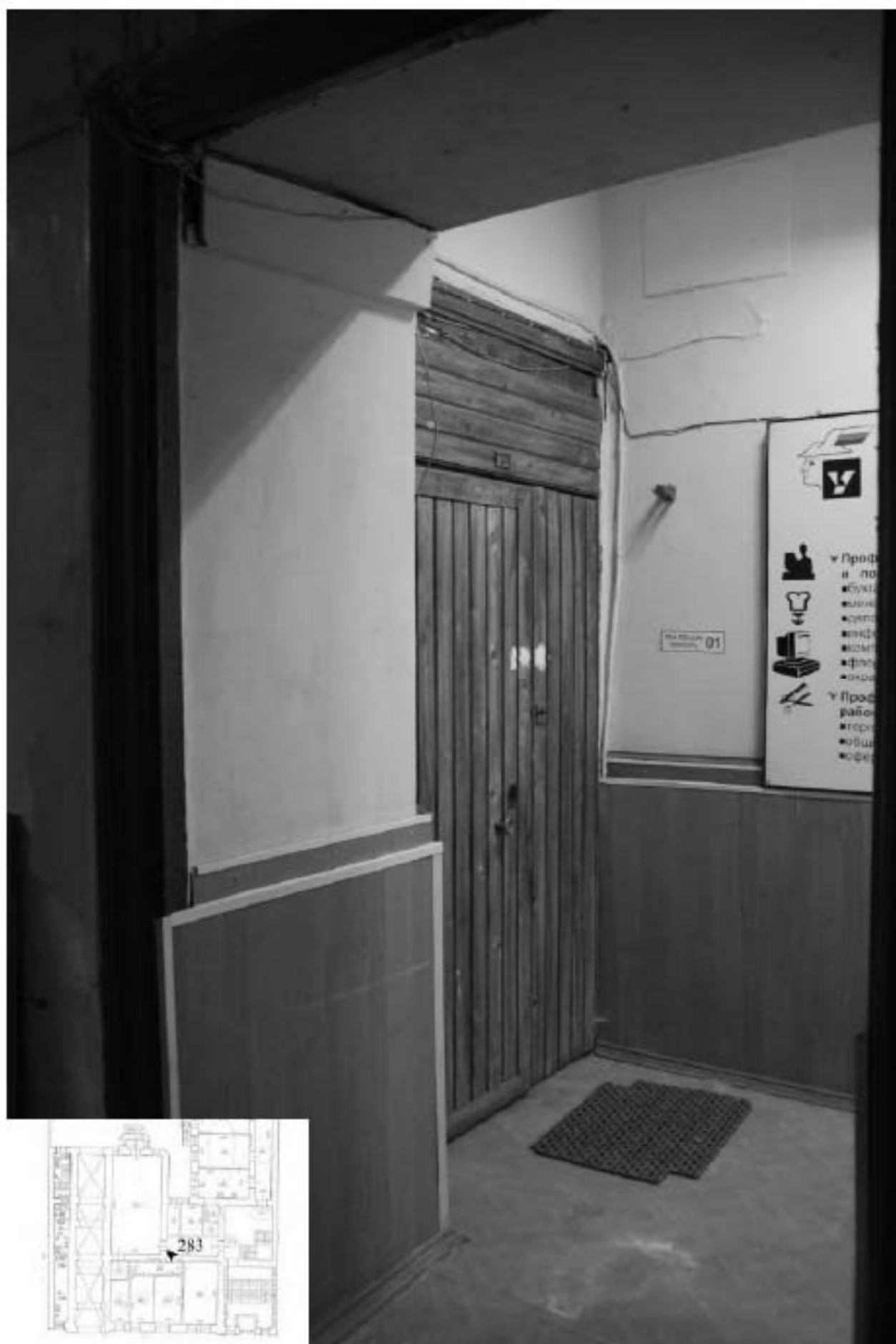
283. Этаж 1, помещение 20-Н. Вид на входную дверь комнаты 32,9 кв.м.
