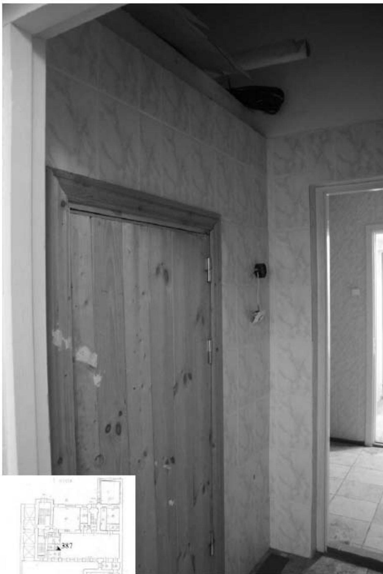
387. Этаж 1, помещение 15-Н. Интерьер душевой.
