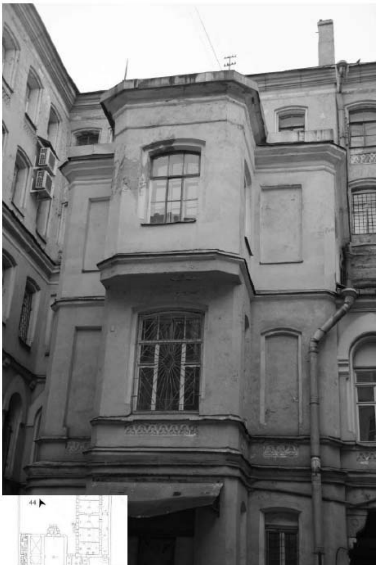
44. Фрагмент дворового фасада лицевого корпуса.
