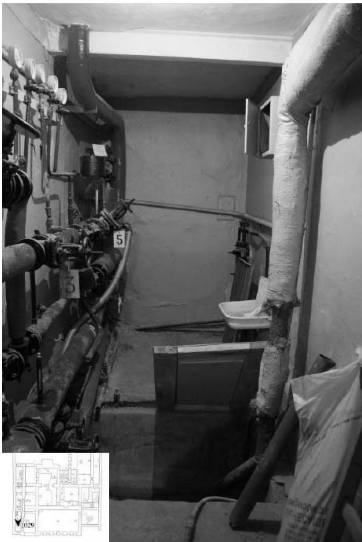
1029. Подвал, интерьер помещения 9-Н.
