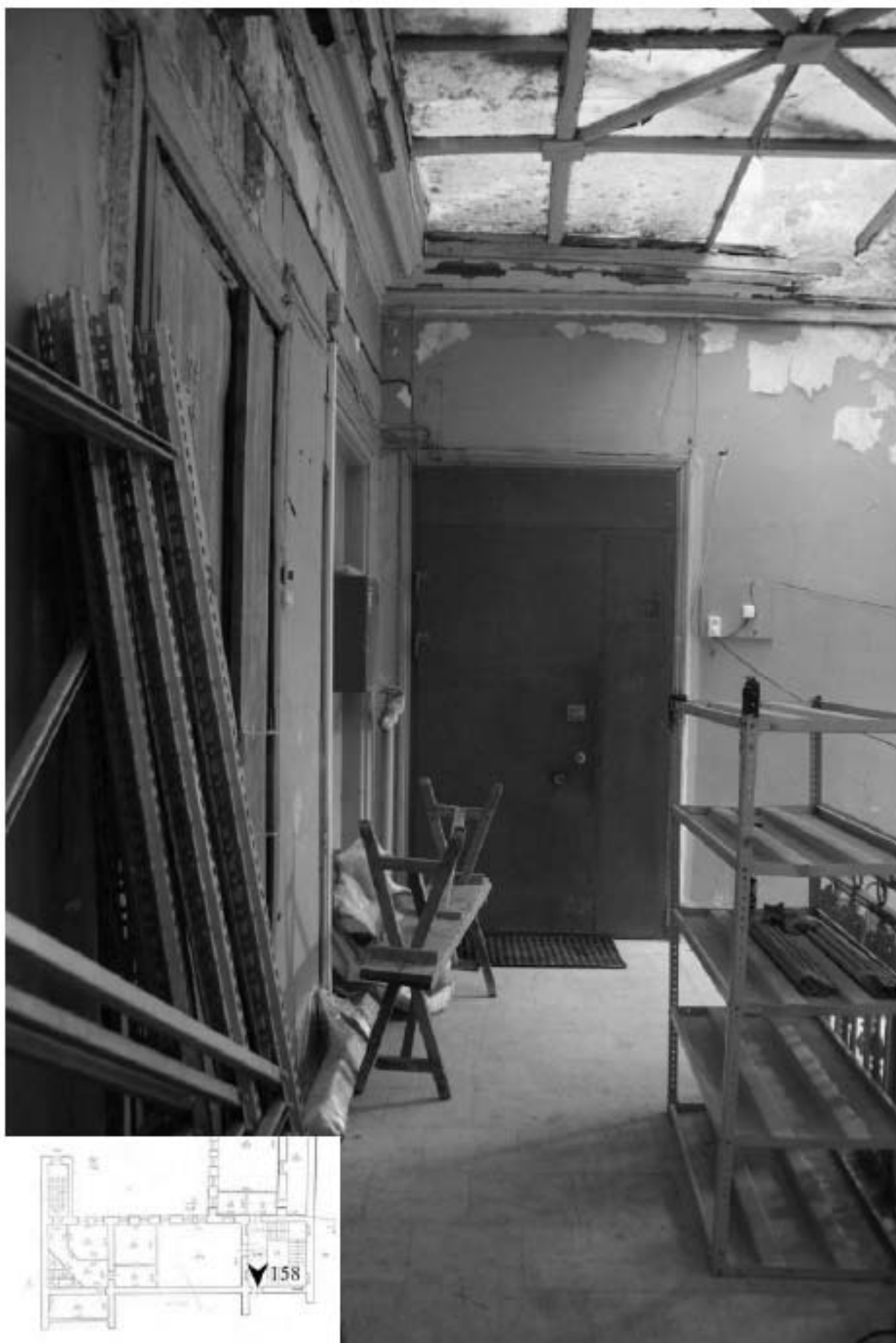
158. Лестничная площадка 5 этажа.
