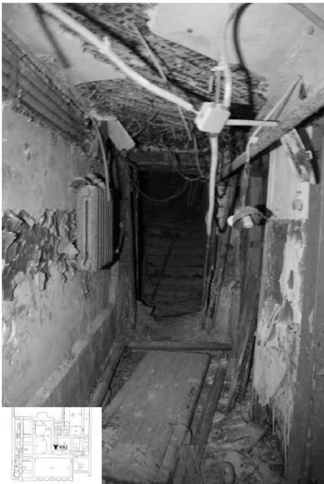
981. Подвал, помещение 6-Н. Вид на лестницу во двор.
