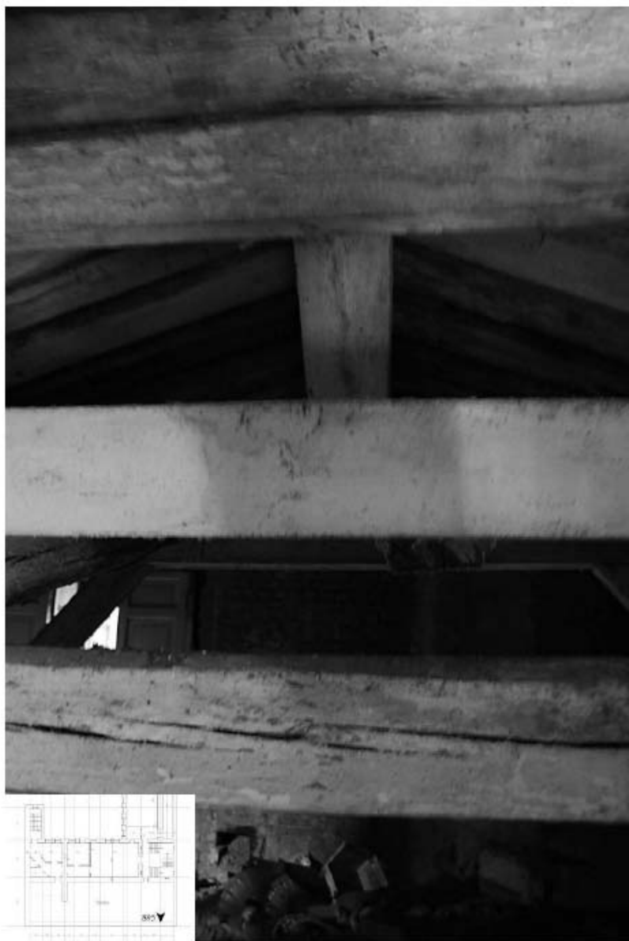
895. Этаж 5, интерьер чердака.
