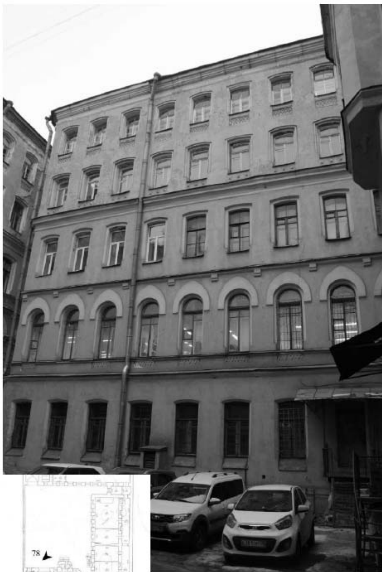
78. Вид дворового фасада.
