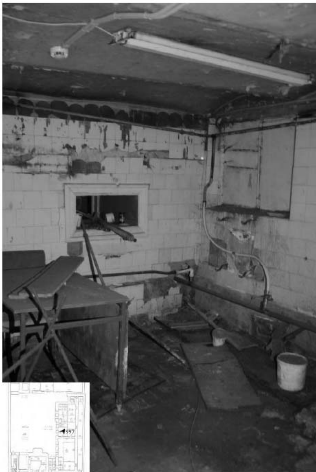
997. Подвал, помещение 6-Н. Интерьер комнаты 10,5 кв.м.
