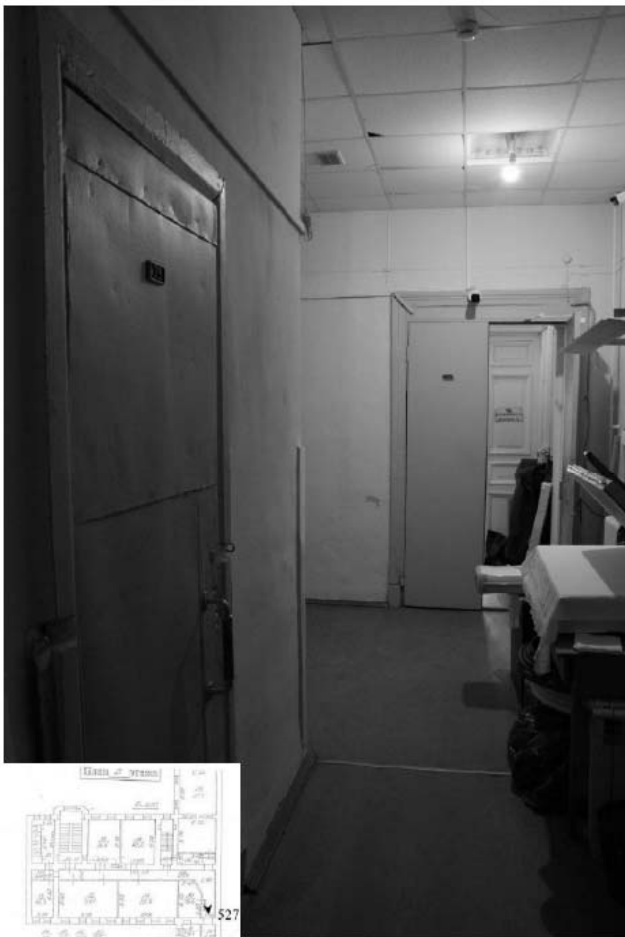
527. Этаж 2, помещение 16-Н. Вид коридора.
