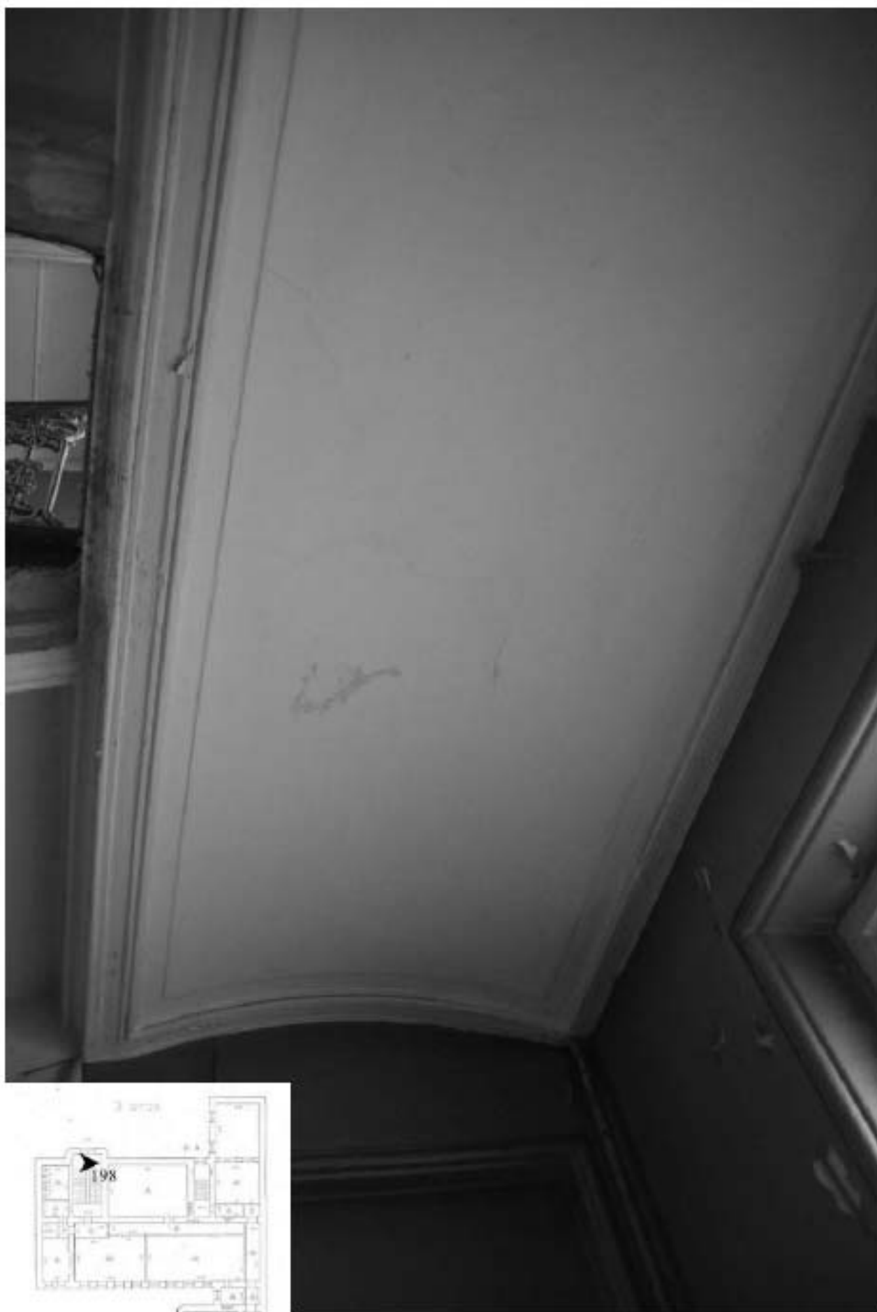
198. Лестница 3ЛК. Своды лестничной площадки.
