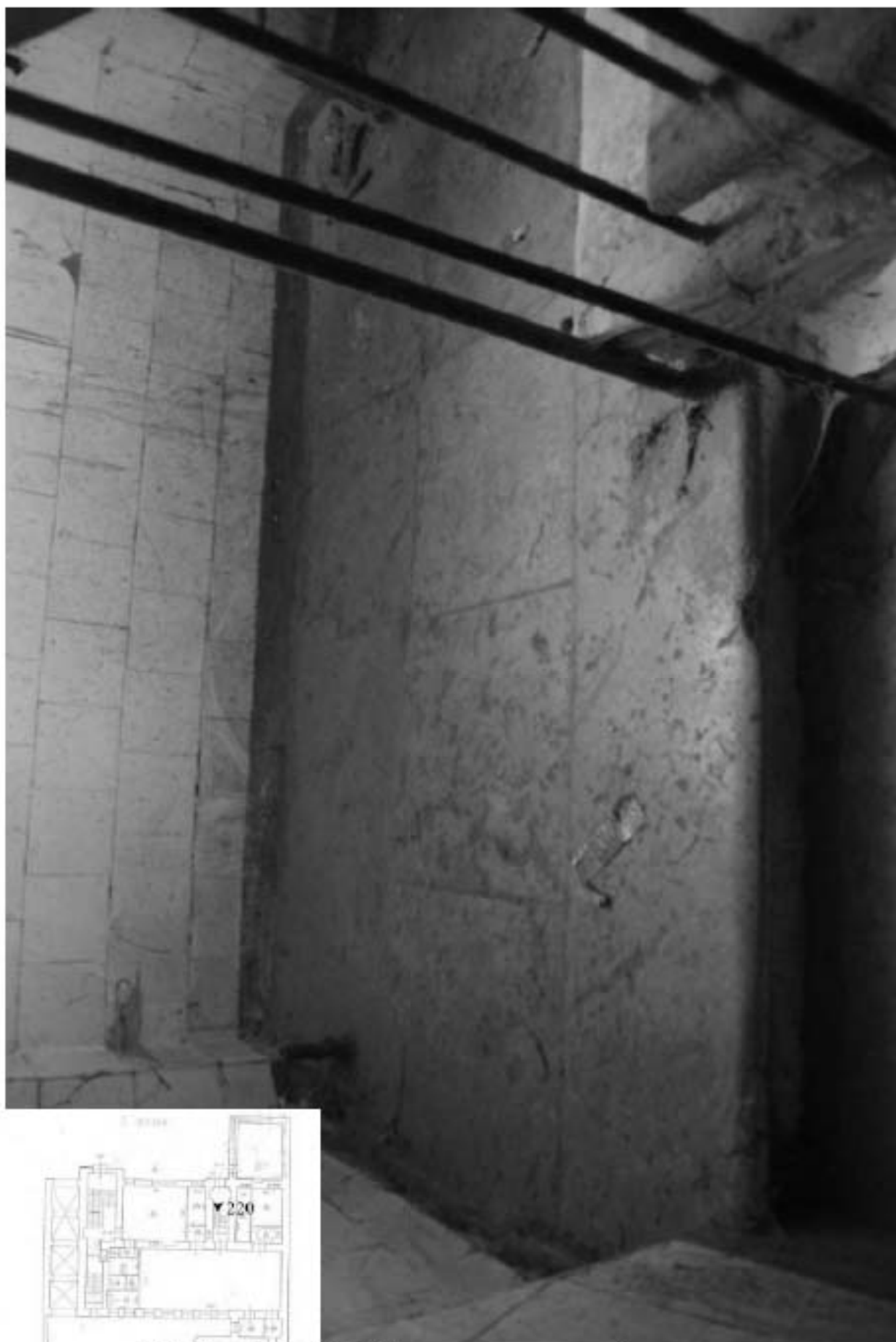
220. Лестница 4ЛК. Покрытие лестничной площадки.
