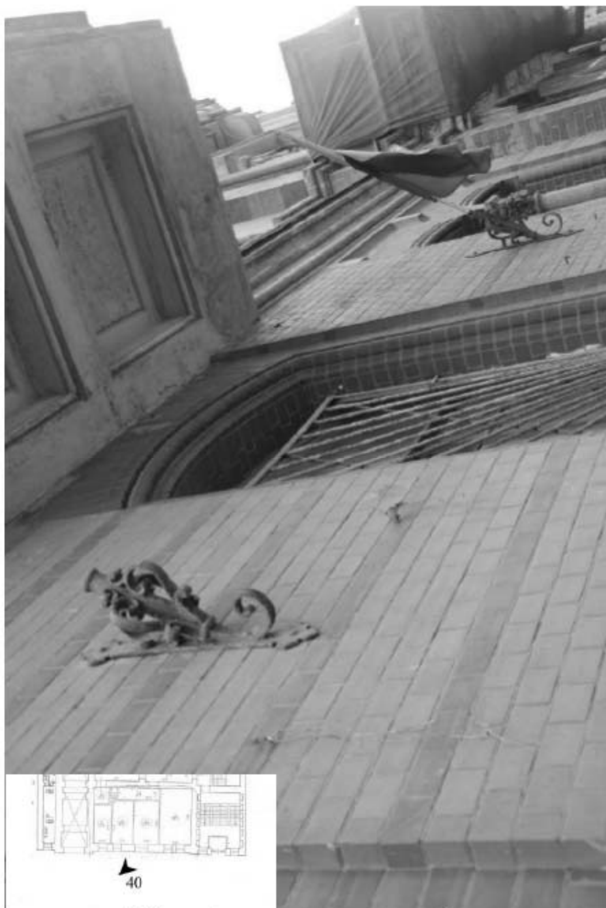
40. Вид на флагодержатели на лицевом фасаде.
