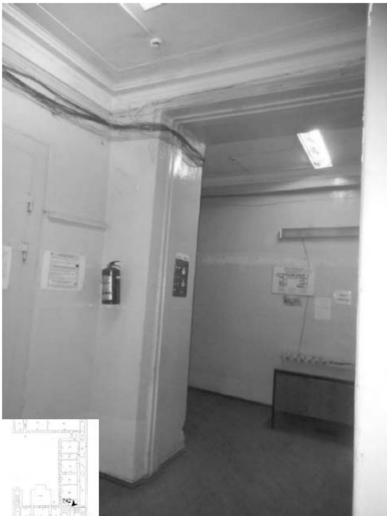
742. Этаж 4, помещение 40-Н. Вид коридора.
