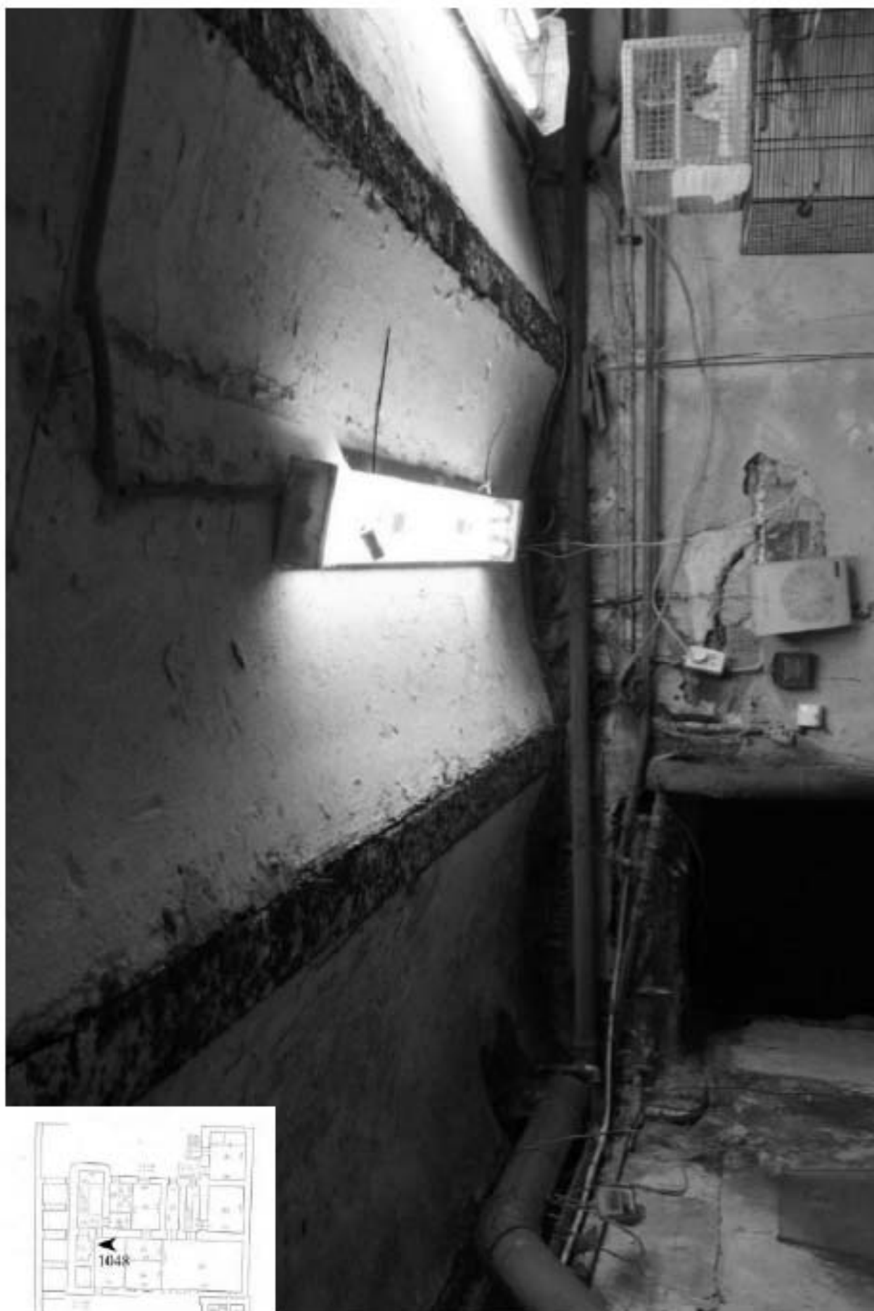
1048. Подвал, помещение 2-Н. Интерьер комнаты 27,9 кв.м.
