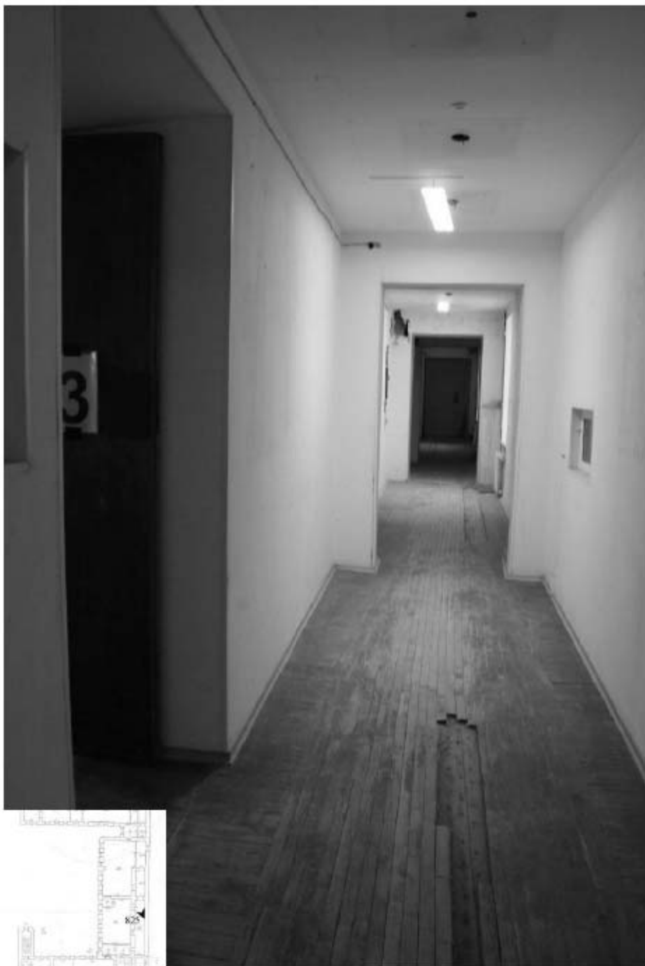
825. Этаж 5, помещение 19-Н. Вид коридора.
