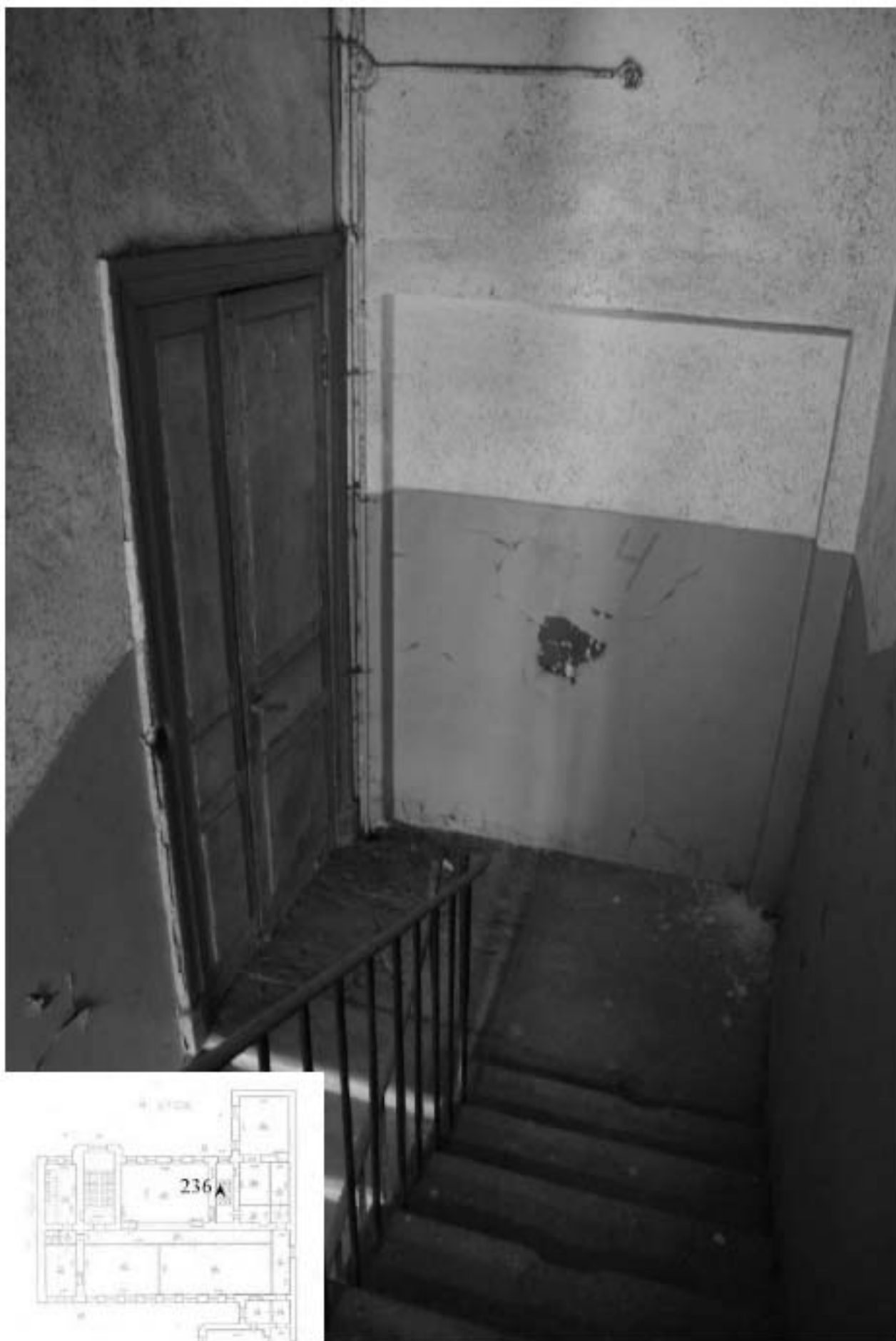
236. Лестница 4ЛК. Лестничная площадка 4 этажа.
