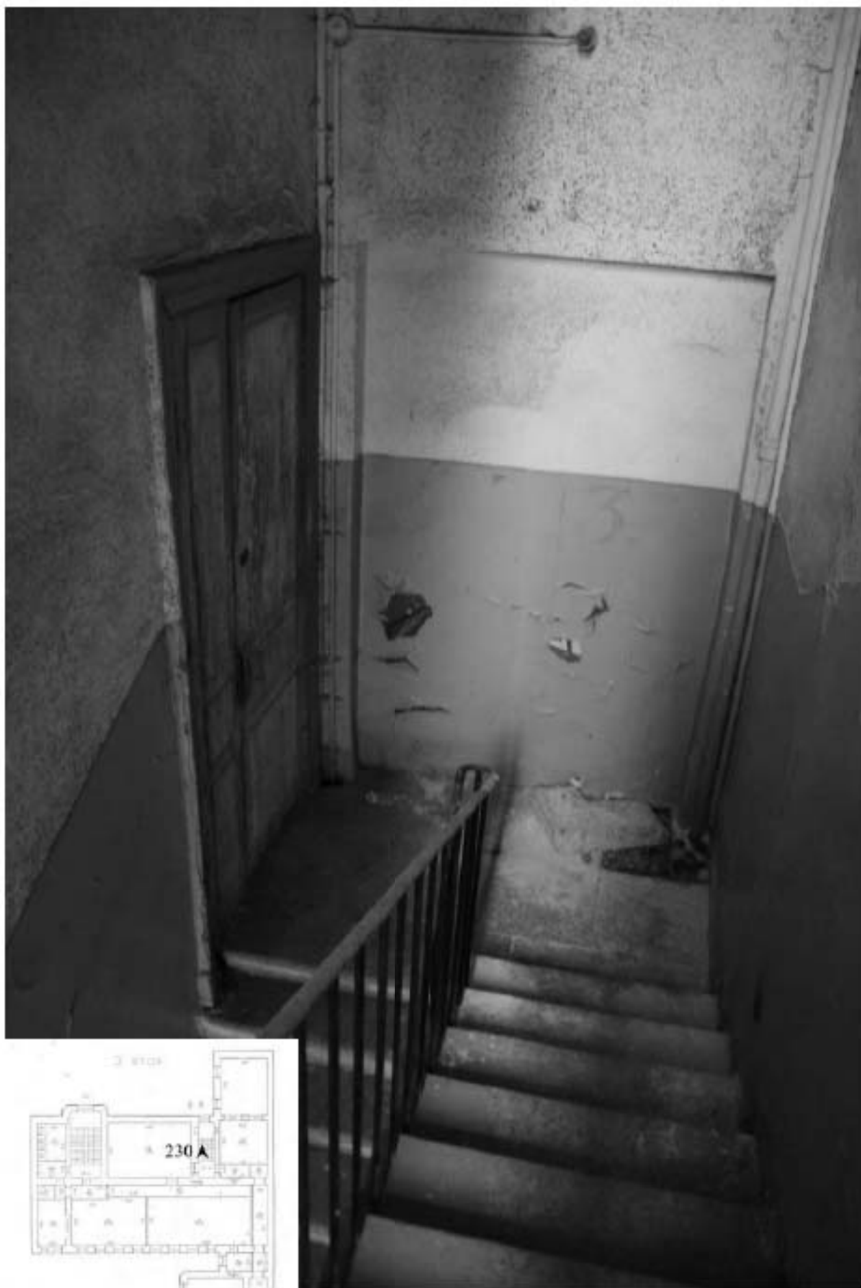
230. Лестница 4ЛК. Лестничная площадка 3 этажа.
