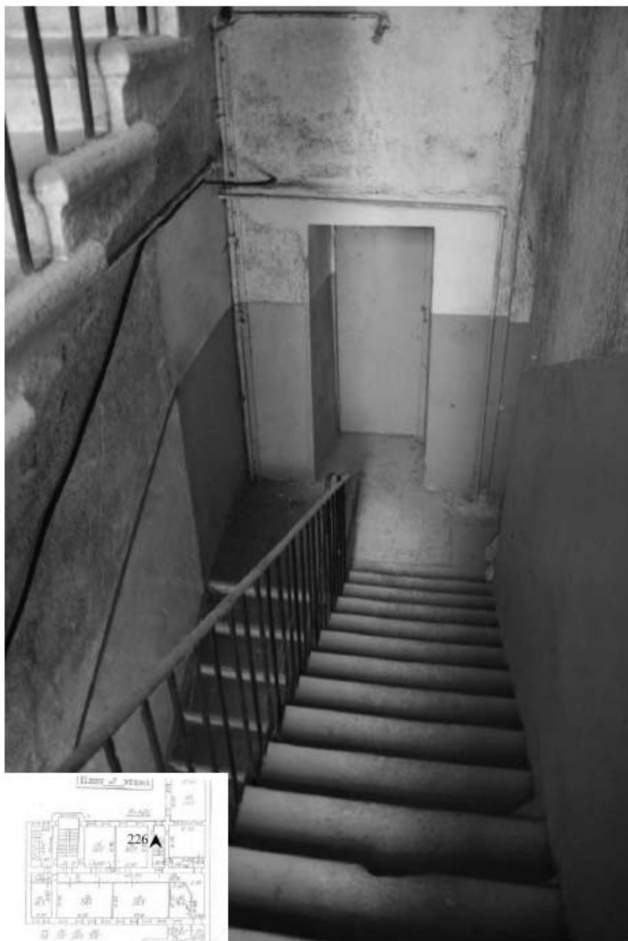
226. Лестница 4ЛК. Вид на лестничную площадку 2 этажа.
