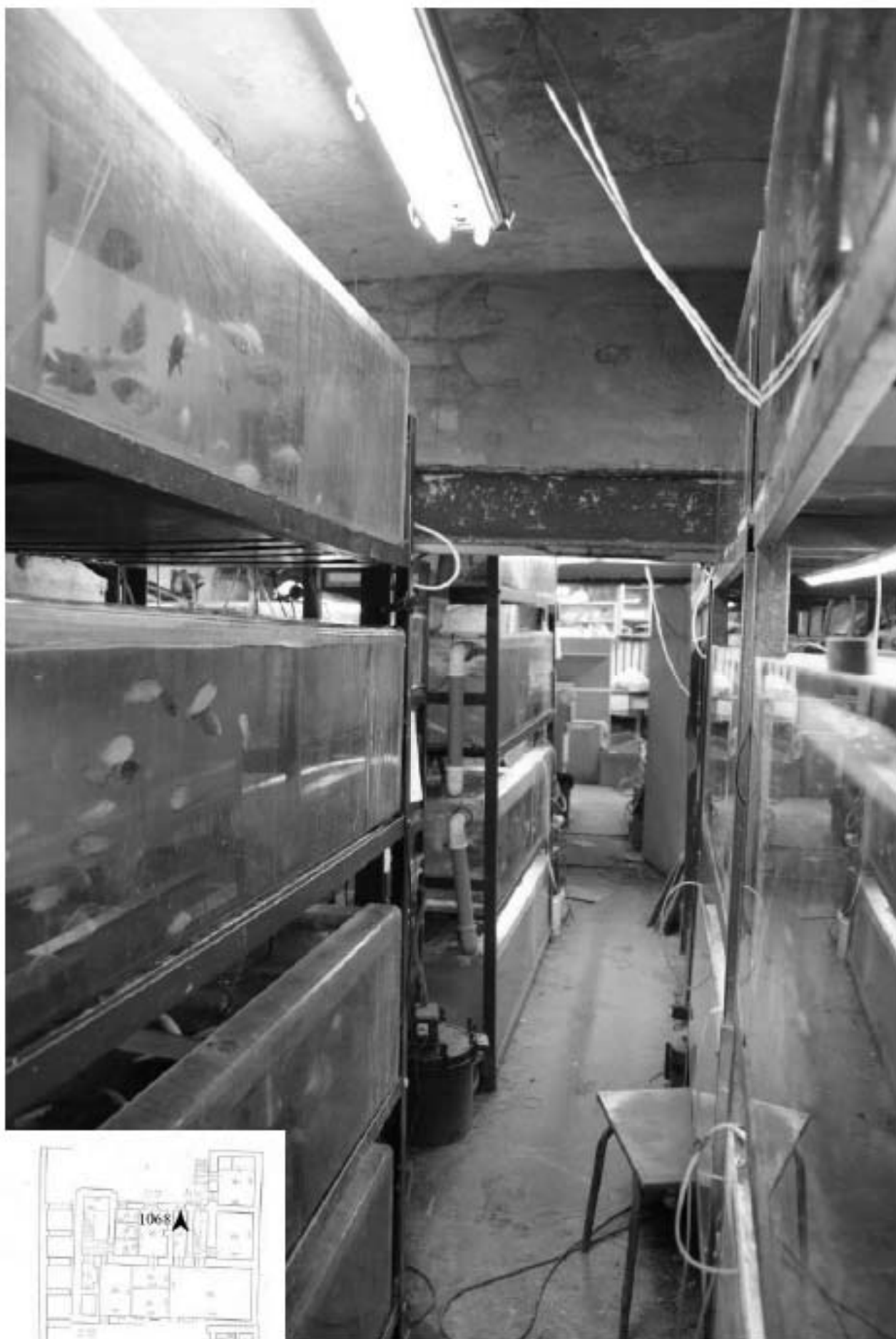
1068. Подвал, помещение 2-Н. Интерьер комнаты 10,4 кв.м.
