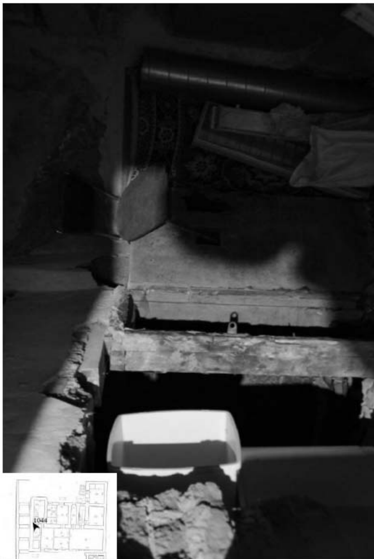
1044. Подвал. Интерьер помещения 5-Н.
