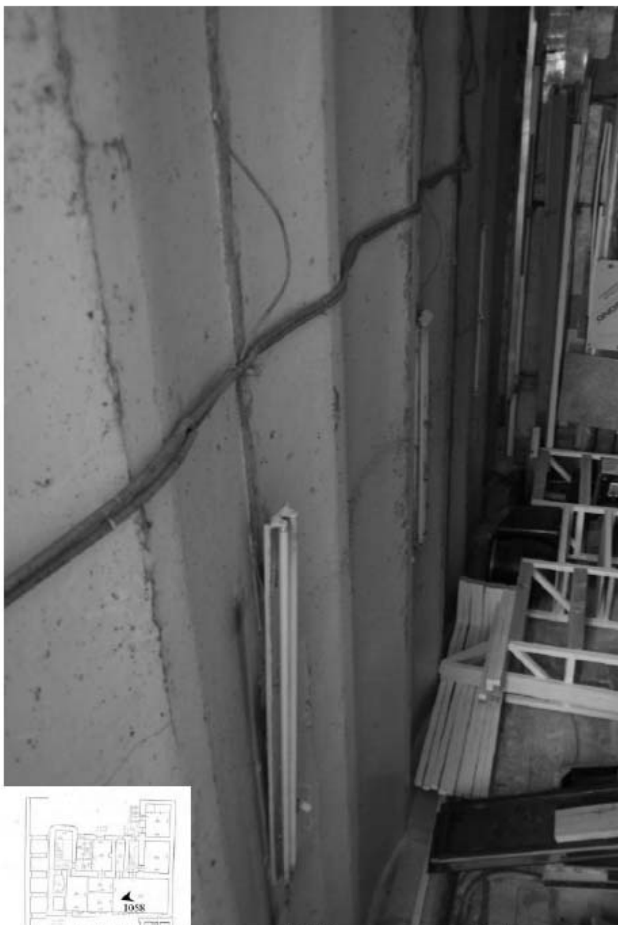
1058. Подвал, помещение 2-Н. Интерьер комнаты 80,1 кв.м.
