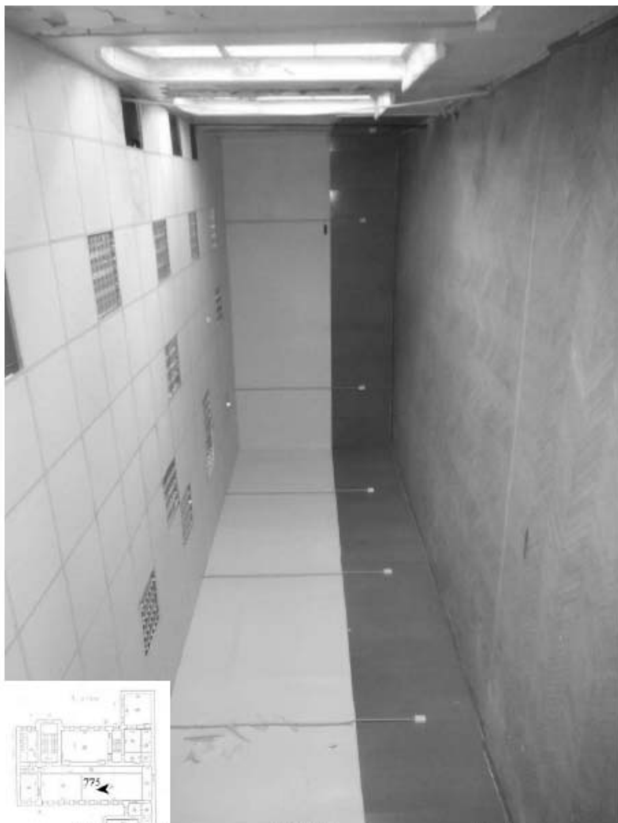
775. Этаж 4, помещение 40-Н. Интерьер комнаты 71,4 кв.м.
