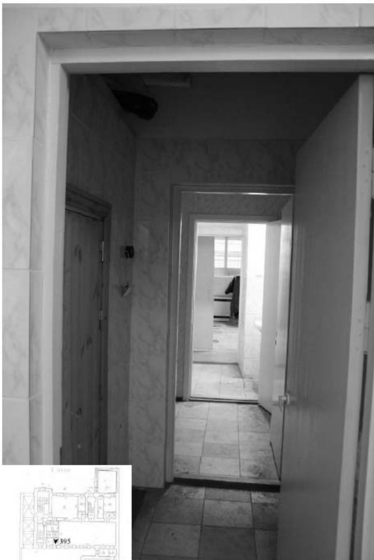
395. Этаж 1, помещение 15-Н. Интерьер душевой.
