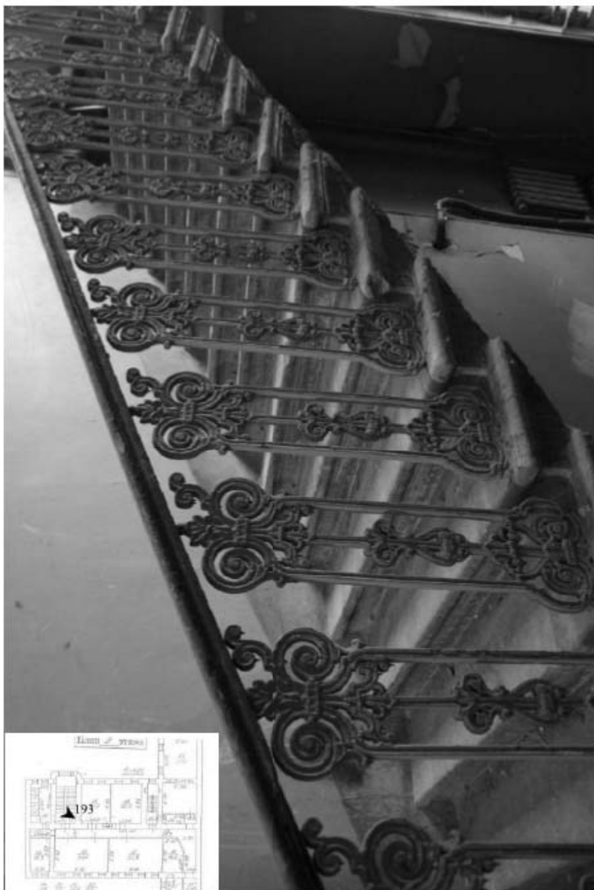
193. Лестница 3ЛК. Ограждение лестницы.
