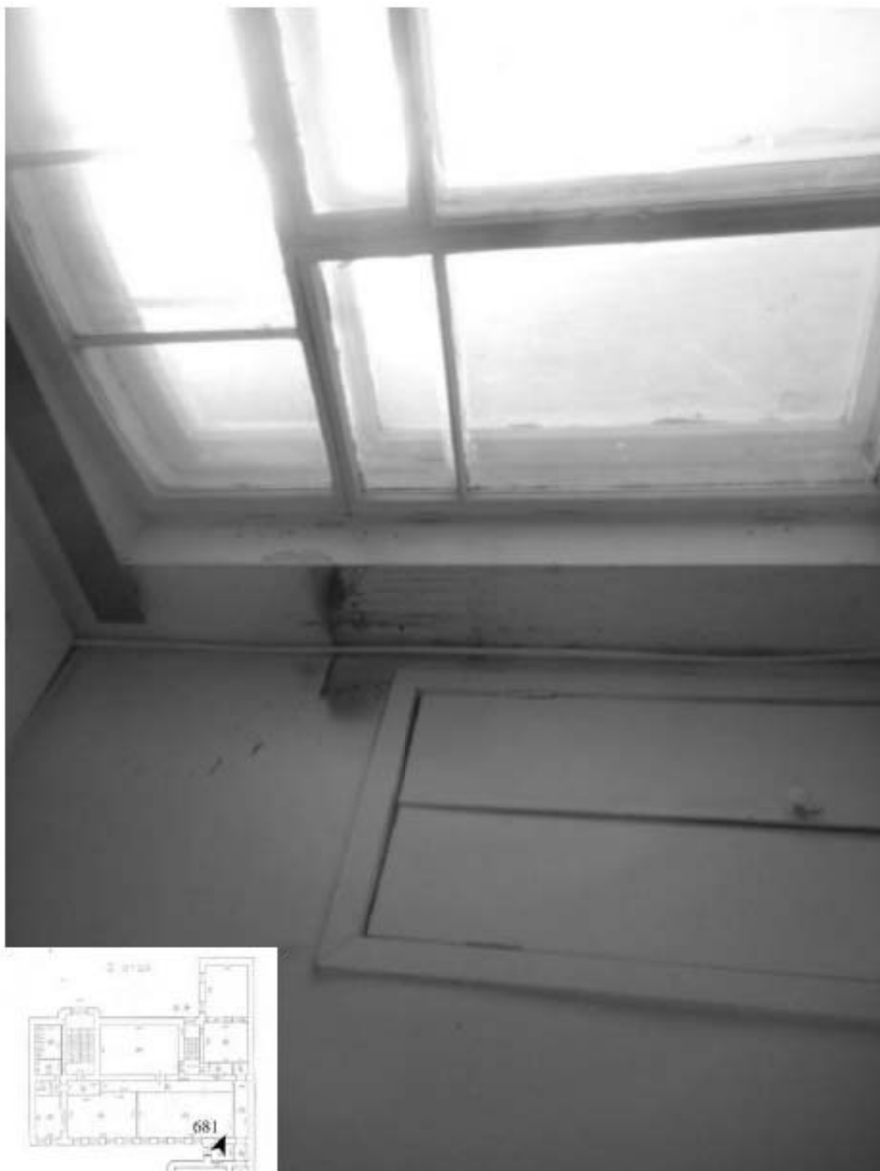
681. Этаж 3, помещение 17-Н. Интерьер комнаты 6,9 кв.м.
