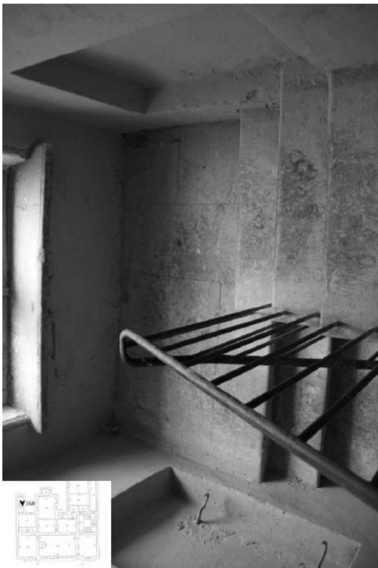
168. Лестница 2ЛК. Покрытие лестничной площадки.
