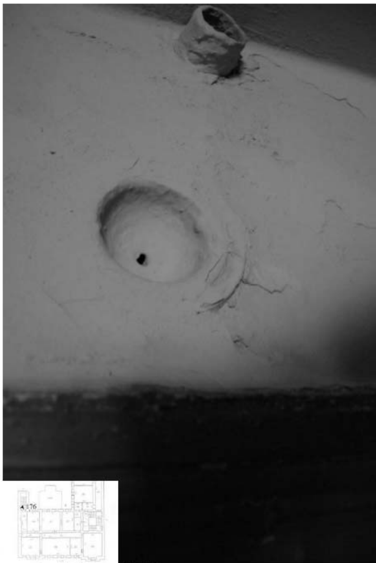
176. Лестница 2ЛК. Вид на отверстие дверного звонка.
