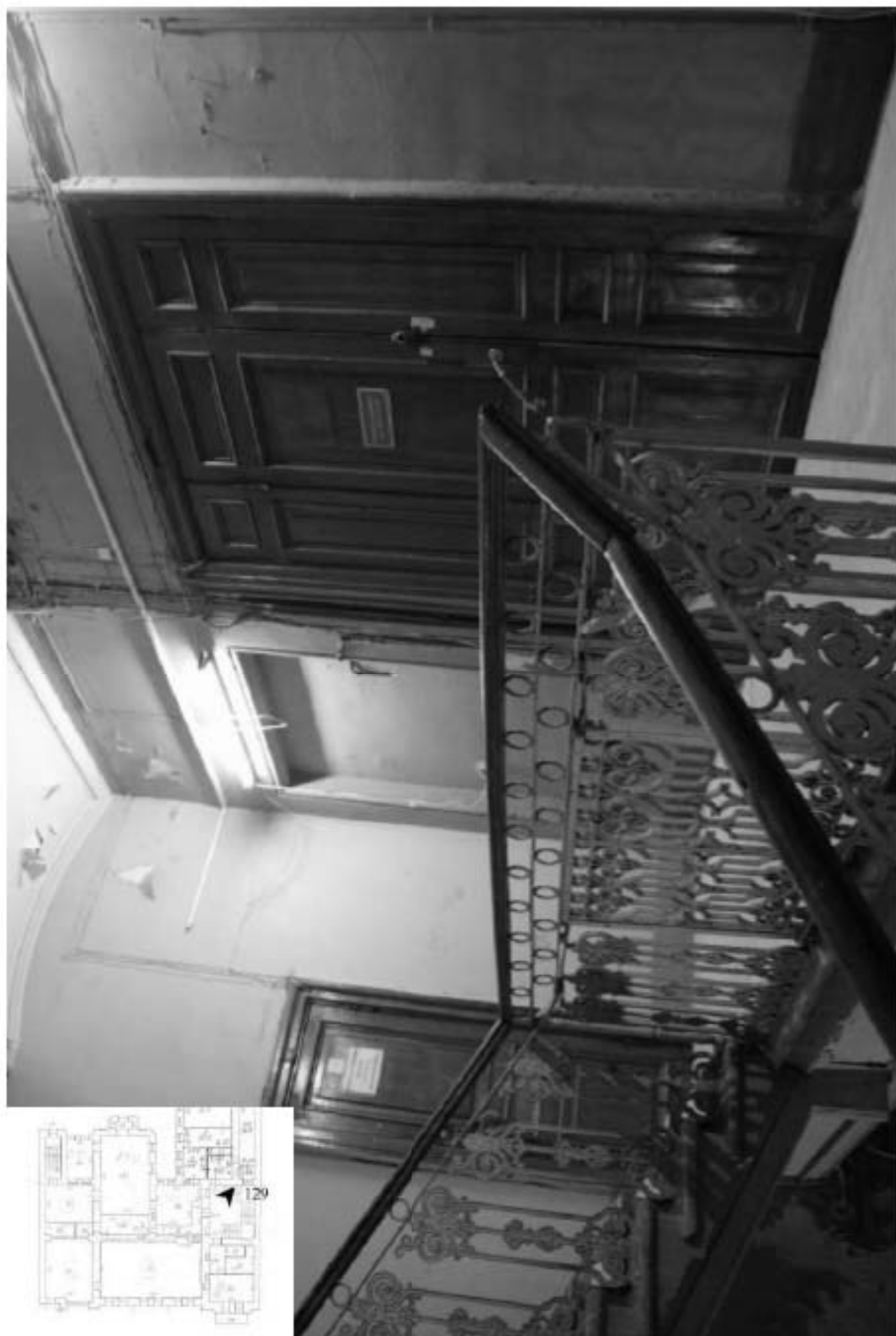
129. Вид на лестничную площадку 2 этажа.
