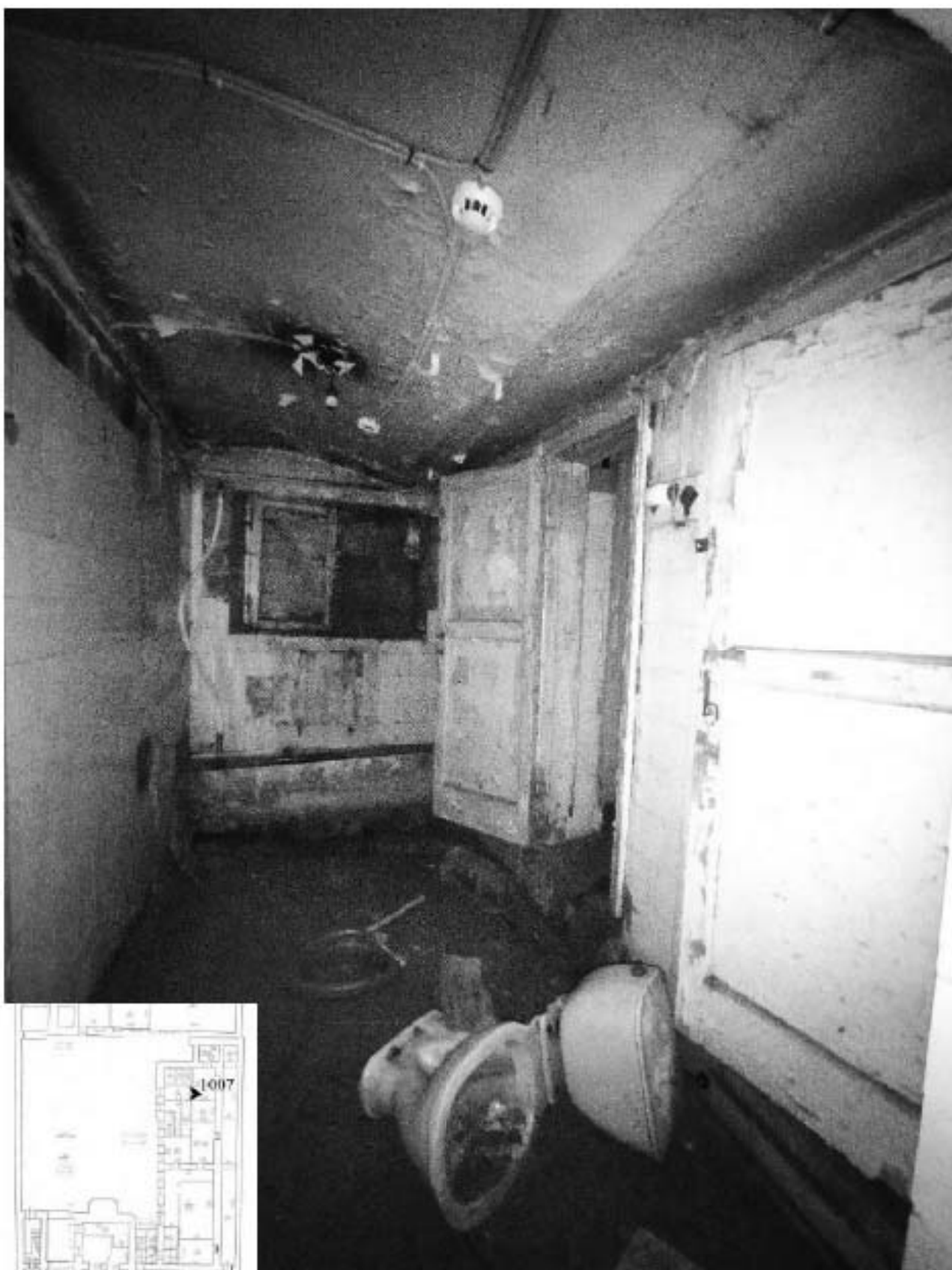
1007. Подвал, помещение 6-Н. Интерьер комнаты 5,9 кв.м.
