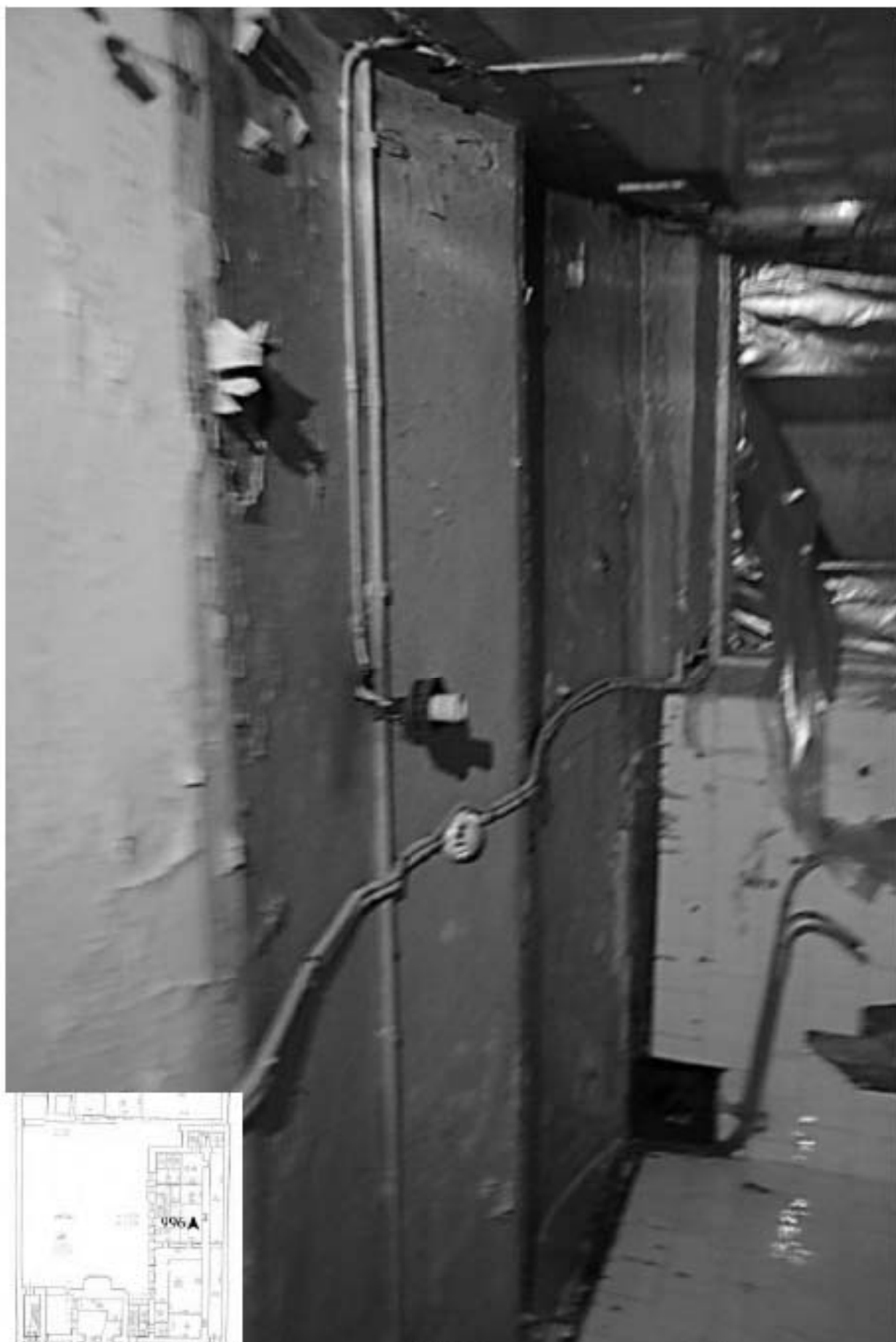
996. Подвал, помещение 6-Н. Интерьер комнаты 14,2 кв.м.
