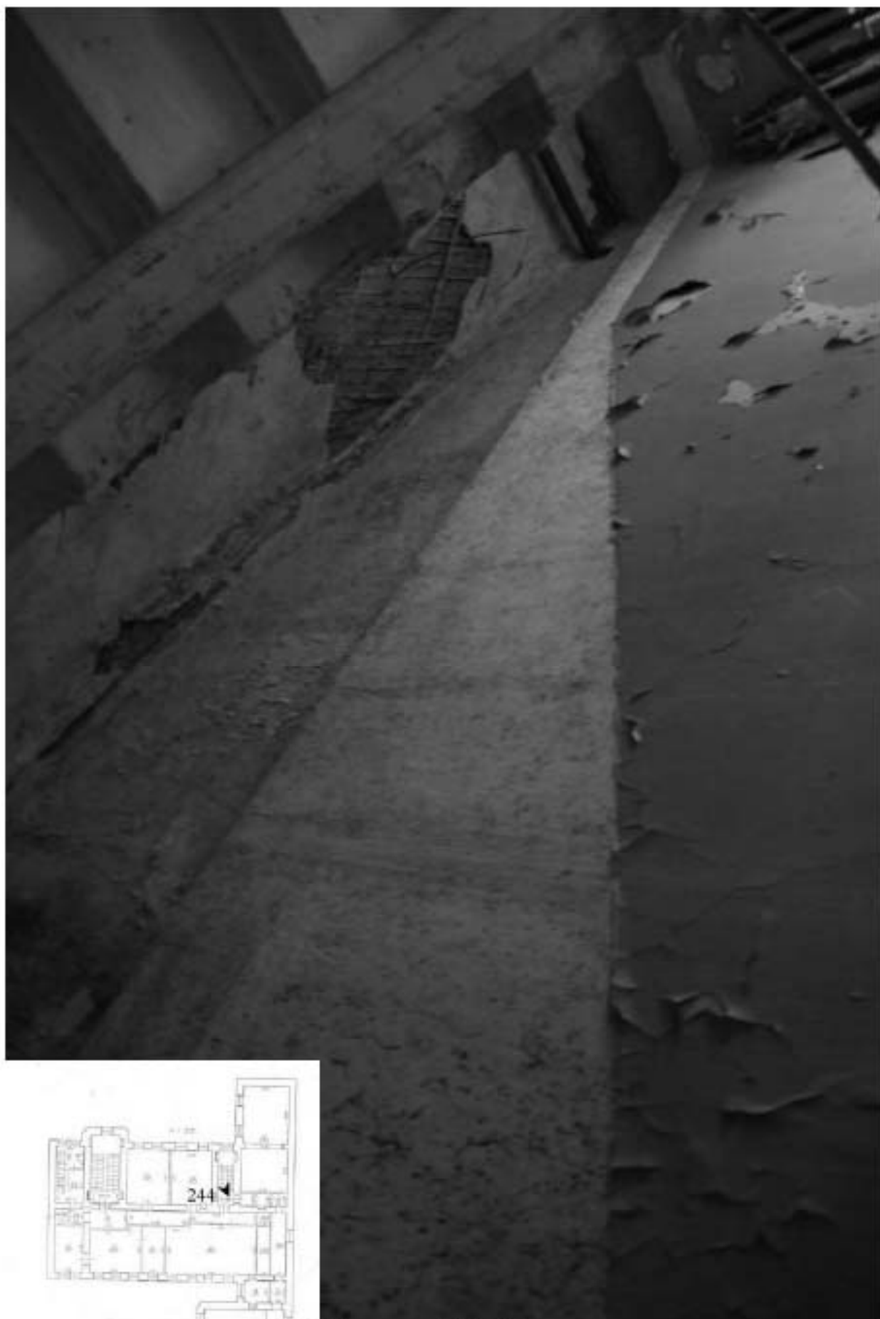
244. Лестница 4ЛК. Фрагмент.
