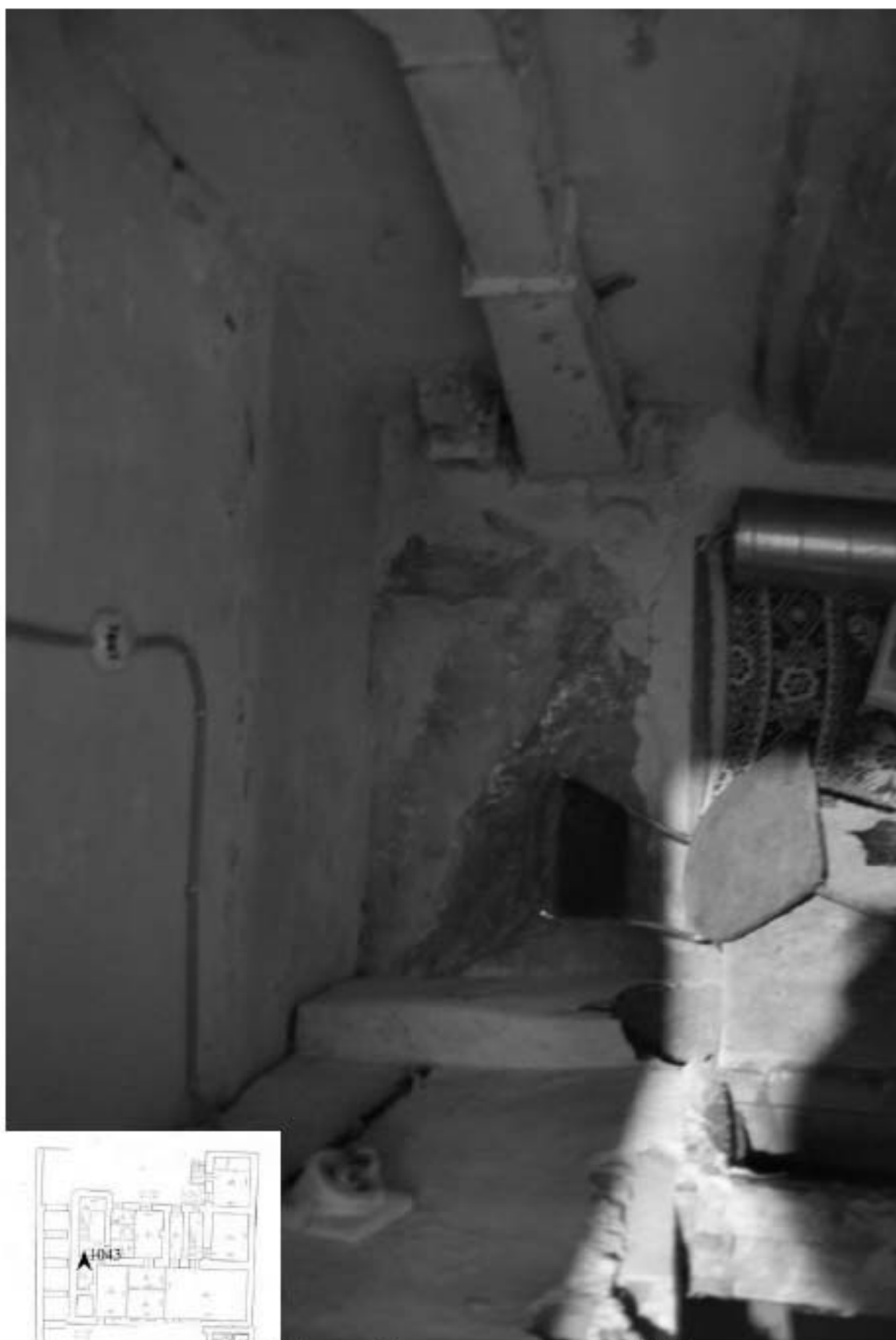
1043. Подвал. Интерьер помещения 5-Н.
