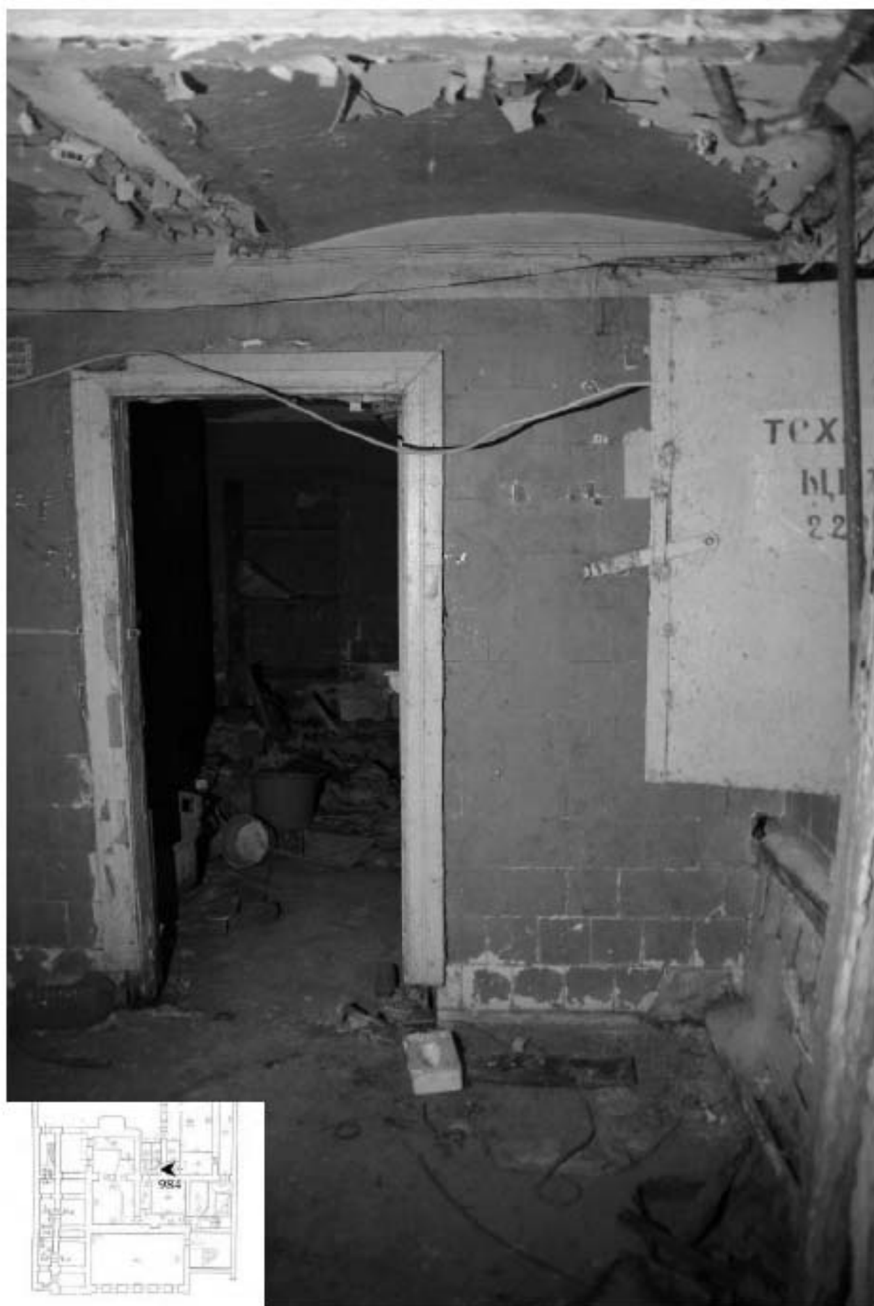
984. Подвал, помещение 6-Н. Интерьер комнаты 2,2 кв.м.
