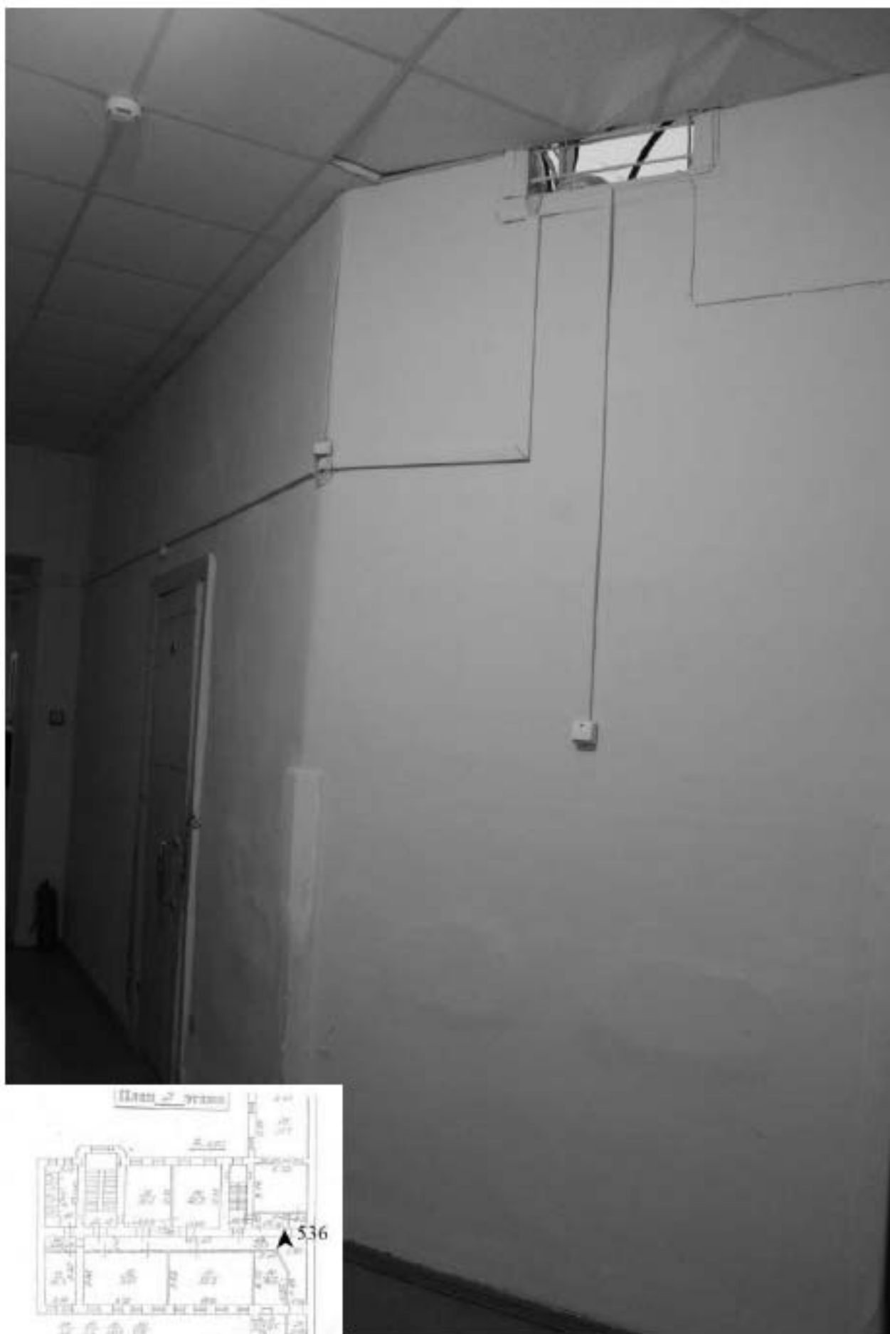
536. Этаж 2, помещение 16-Н. Вид коридора.
