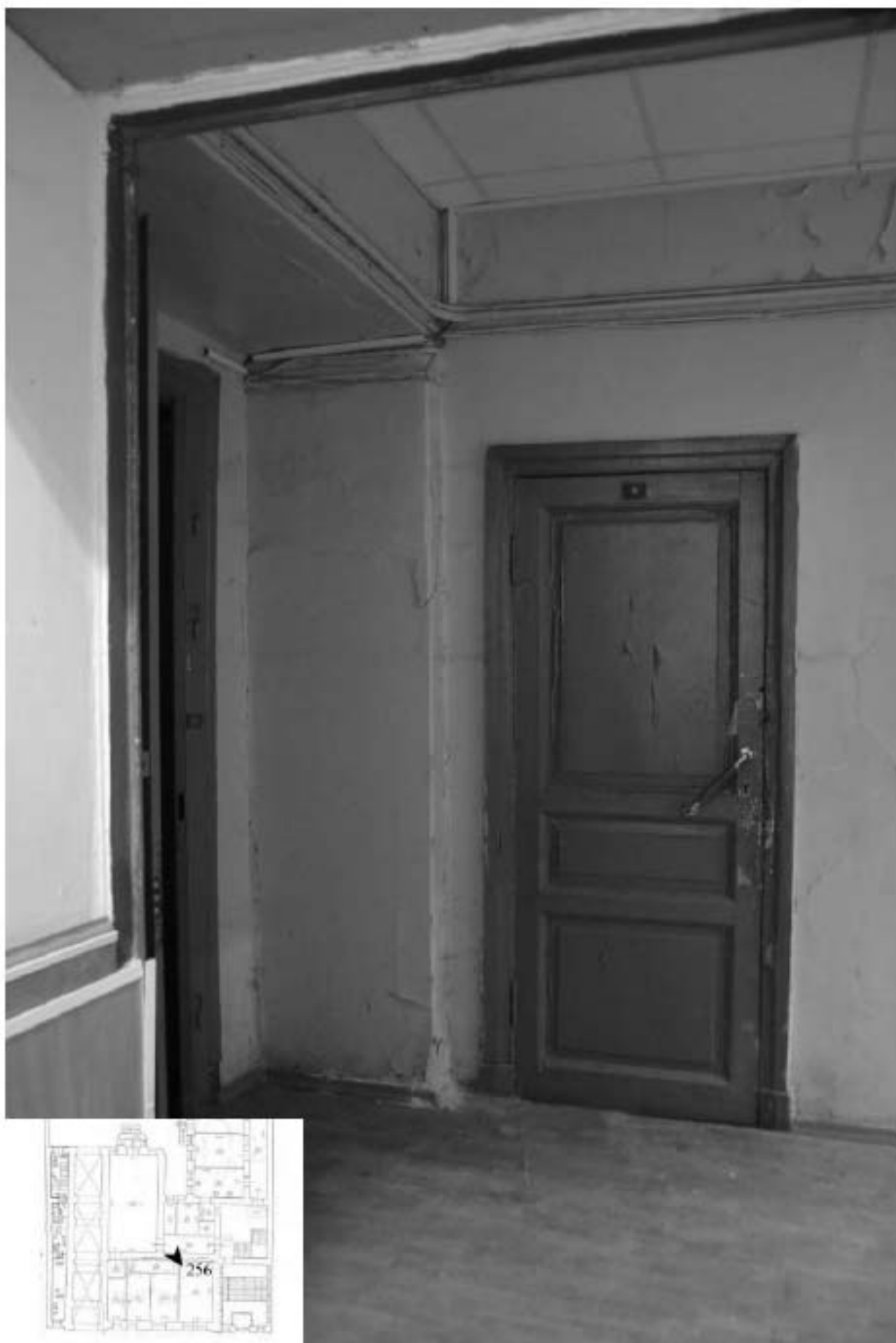
256. Этаж 1, помещение 20-Н. Вид на входную дверь в комнату 5,6 кв.м.
