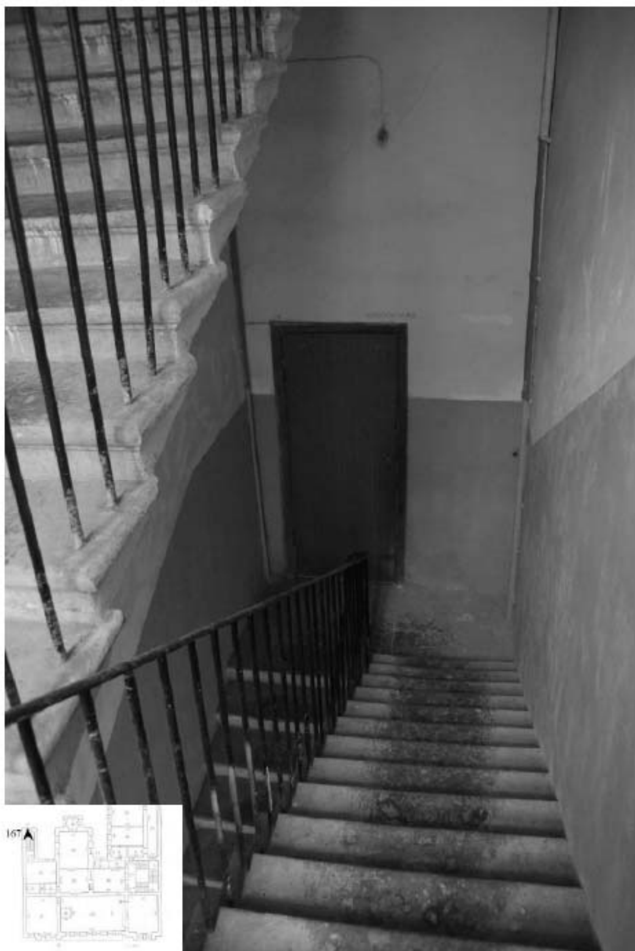
167. Лестница 2ЛК. Вид на лестничную площадку 2 этажа.
