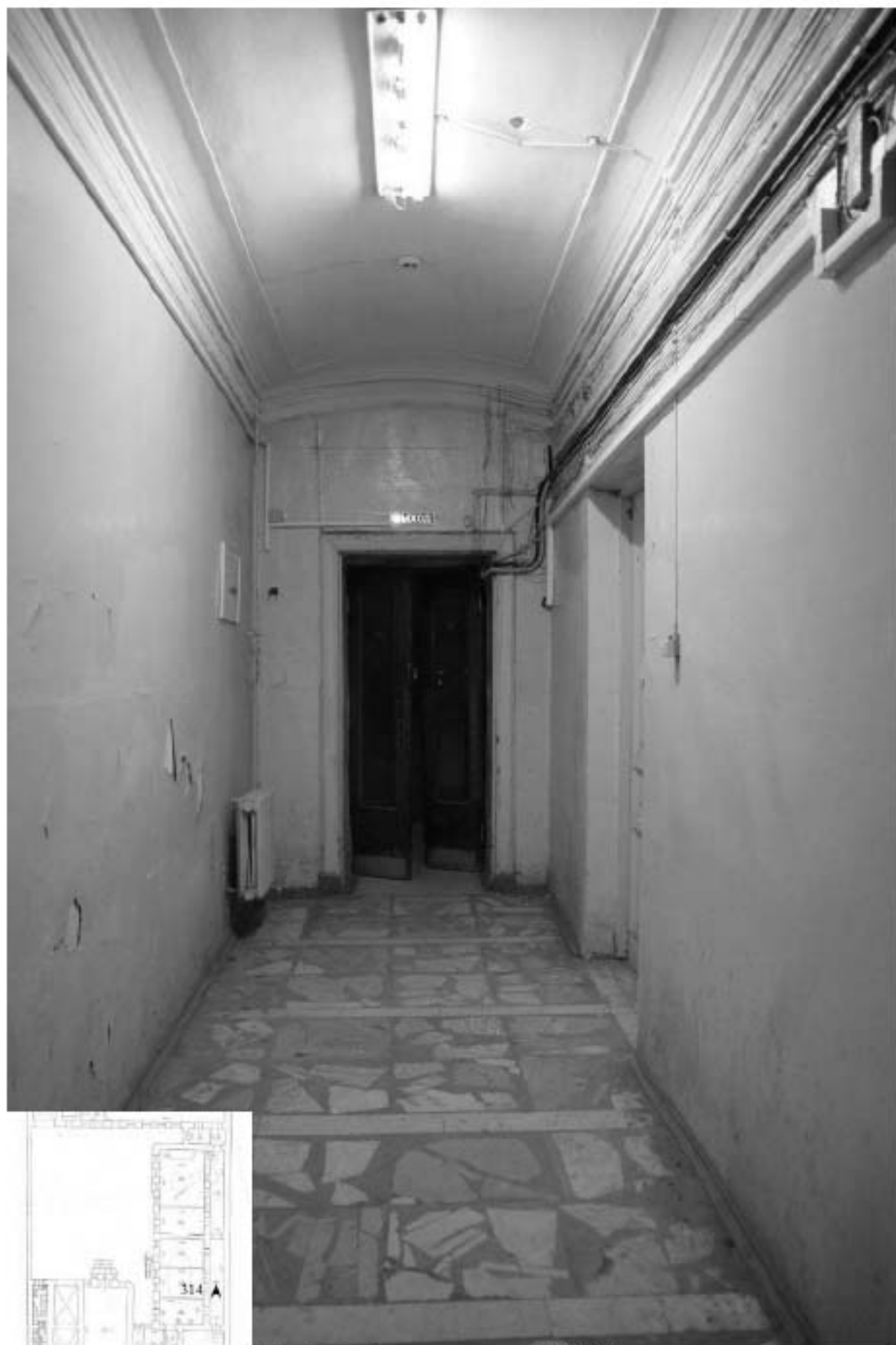
314. Этаж 1, помещение 15-Н. Вид коридора.
