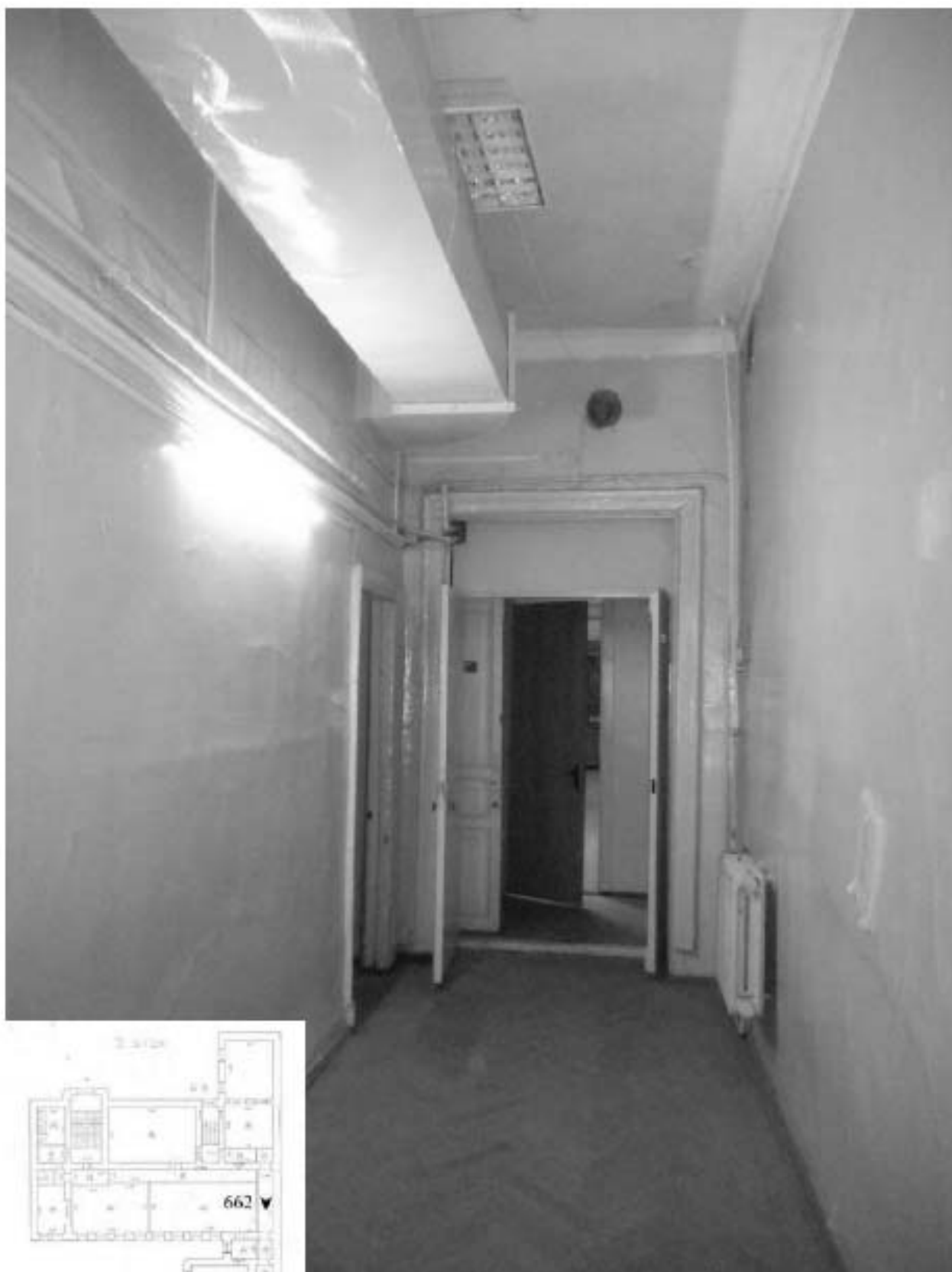
662. Этаж 3, помещение 17-Н. Вид коридора.
