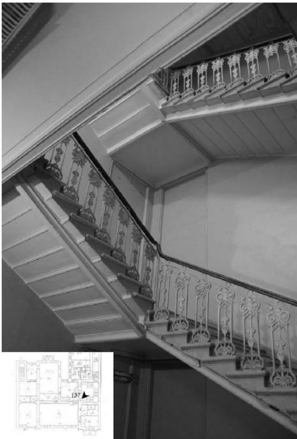
137. Вид парадной лестницы.
