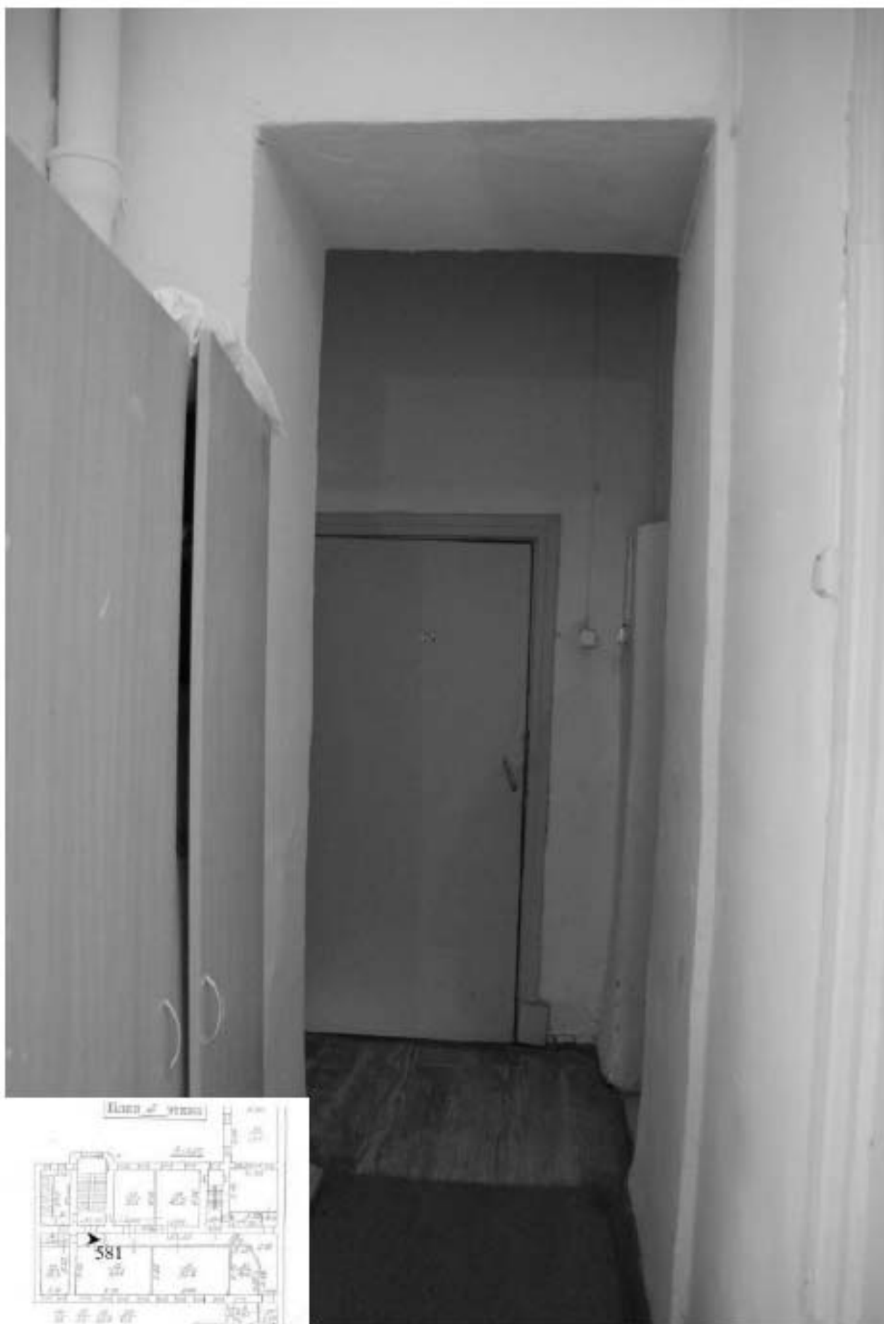
581. Этаж 2, помещение 16-Н. Вид комнаты 15.
