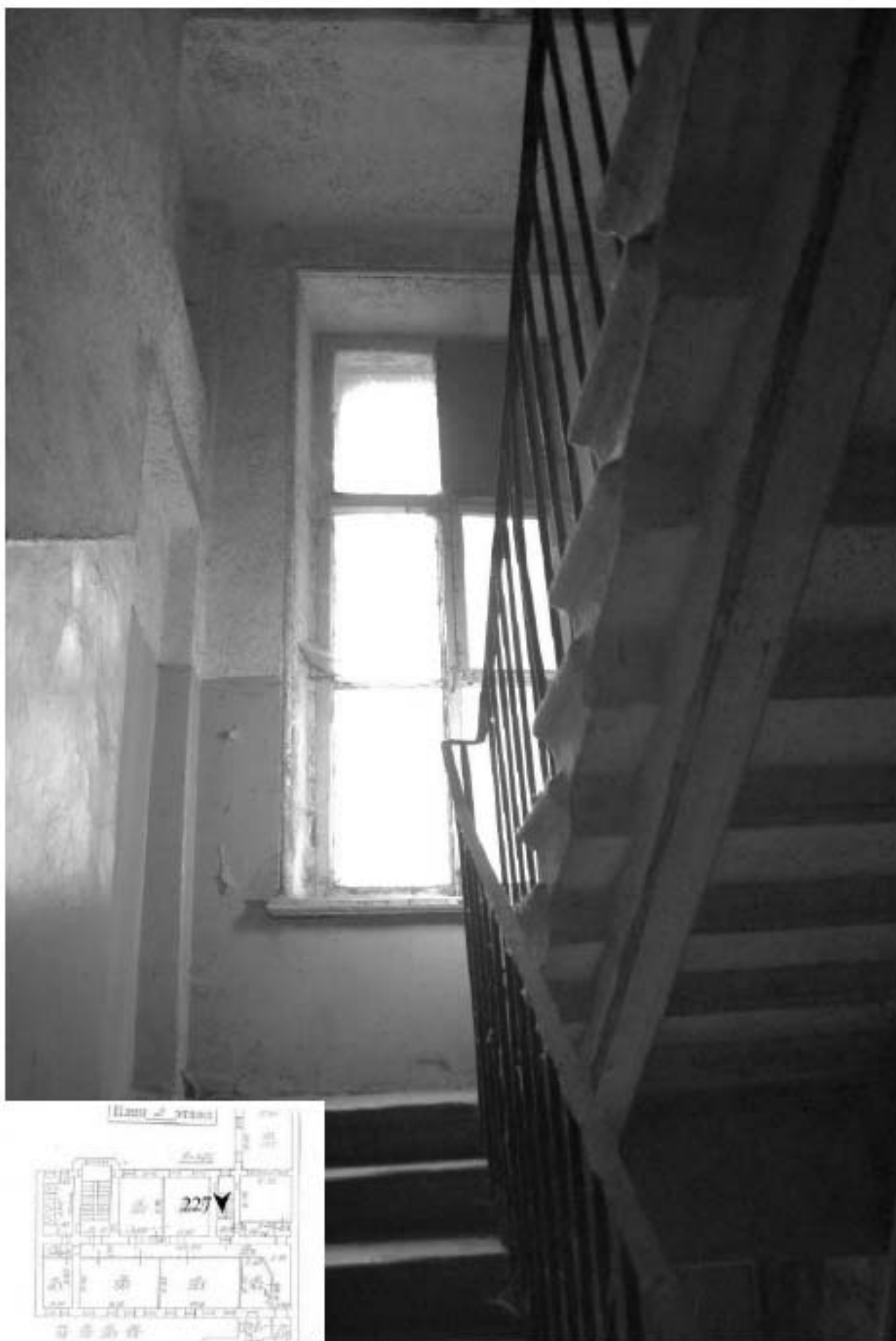
227. Лестница 4ЛК. Вид на лестничную площадку между 2 и 3 этажами.
