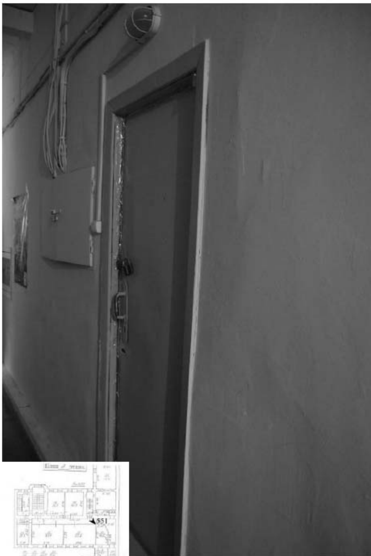
551. Этаж 2, помещение 16-Н. Вид коридора.
