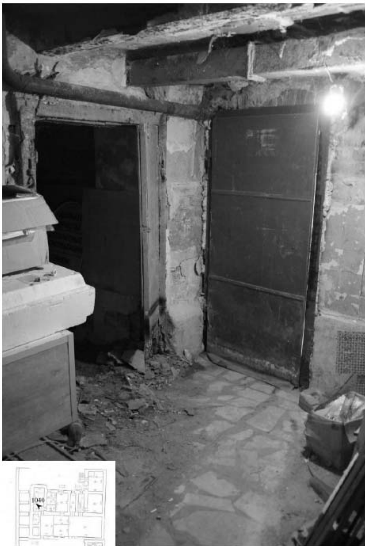
1040. Вход в подвал с лестницы ЗЛК.
