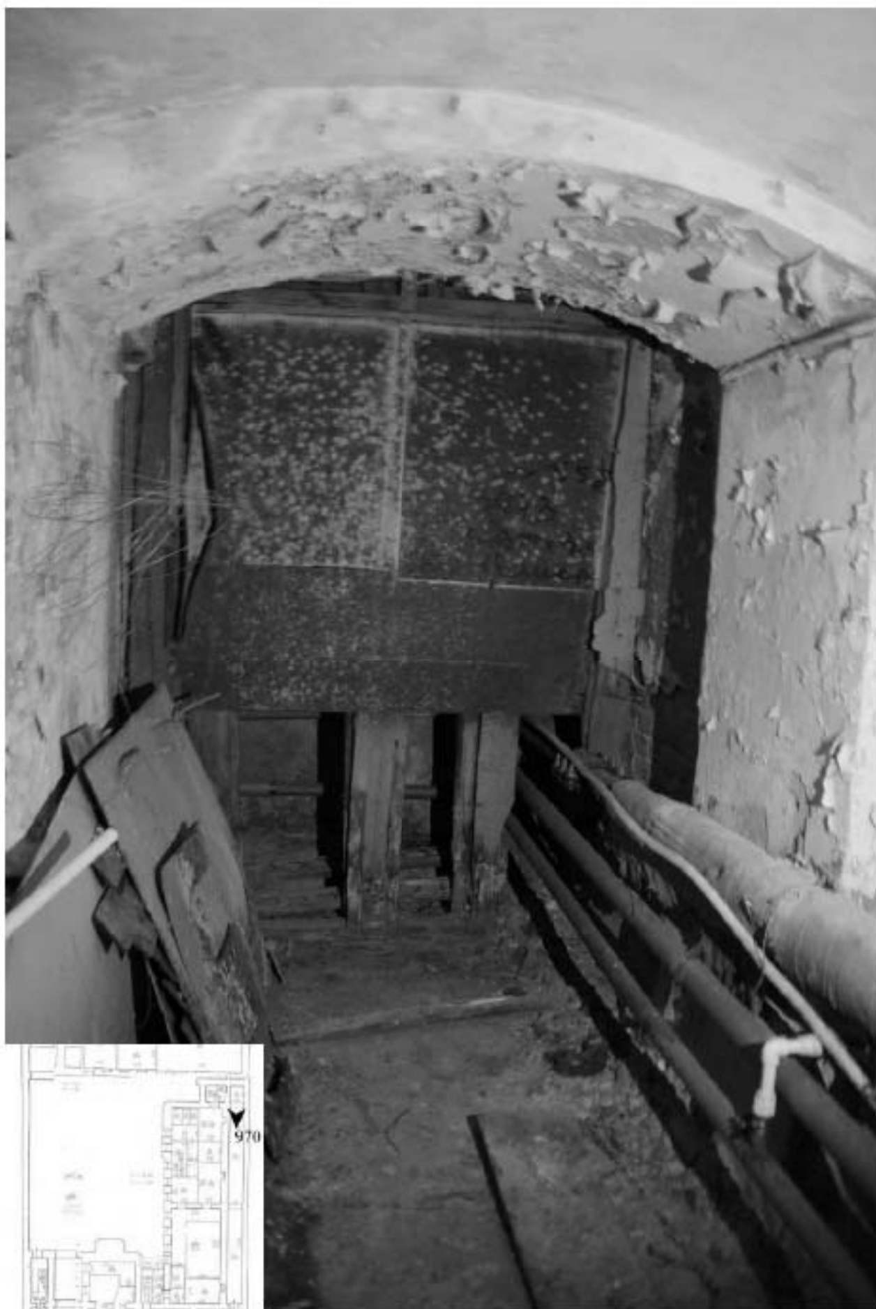
970. Подвал. Интерьер помещения 29-Н.
