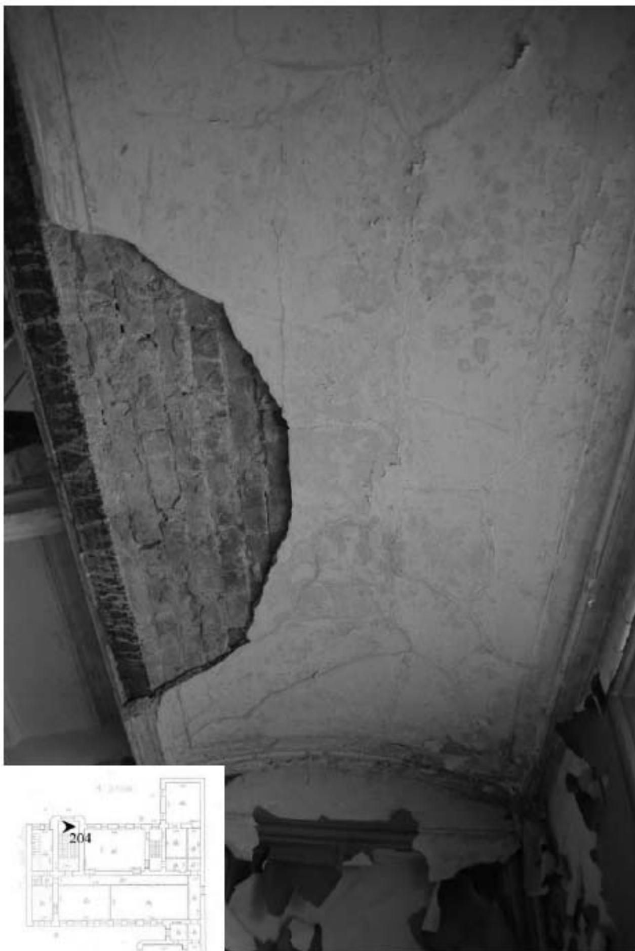
204. Лестница 3ЛК. Своды лестничной площадки.
