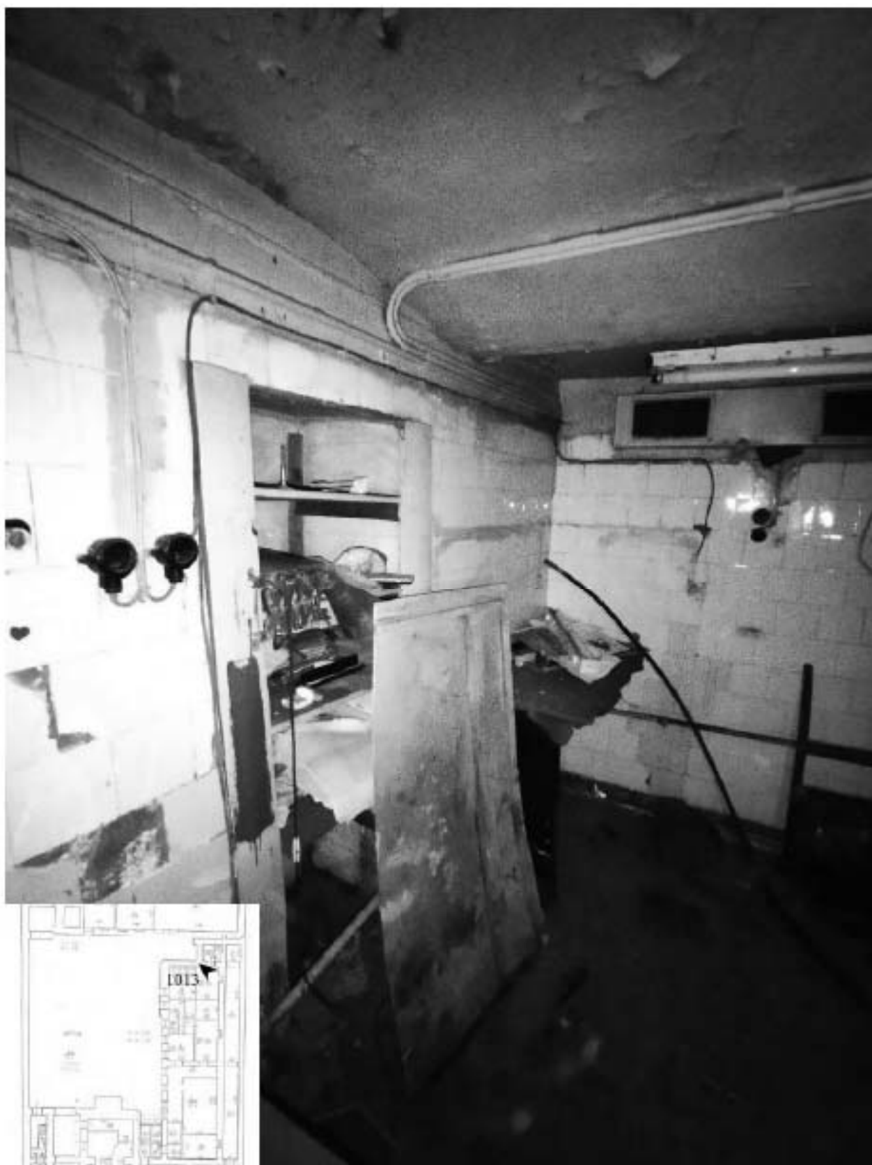
1013. Подвал, помещение 6-Н. Интерьер комнаты 9,9 кв.м.
