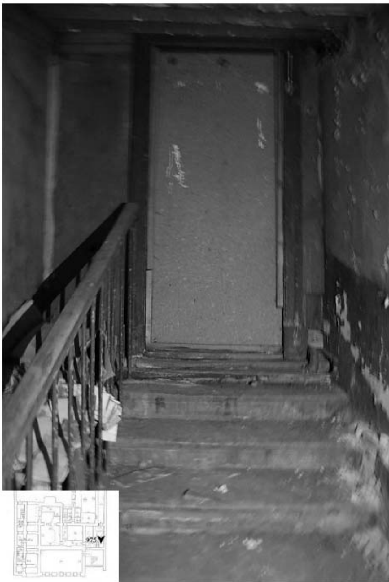
975. Подвал, помещение 6-Н. Интерьер лестницы на 1 этаж.
