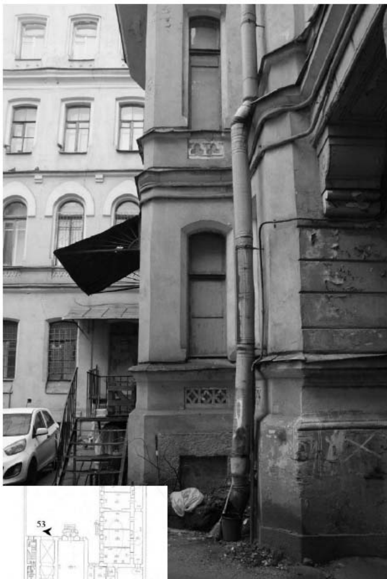
53. Фрагмент дворового фасада лицевого корпуса.
