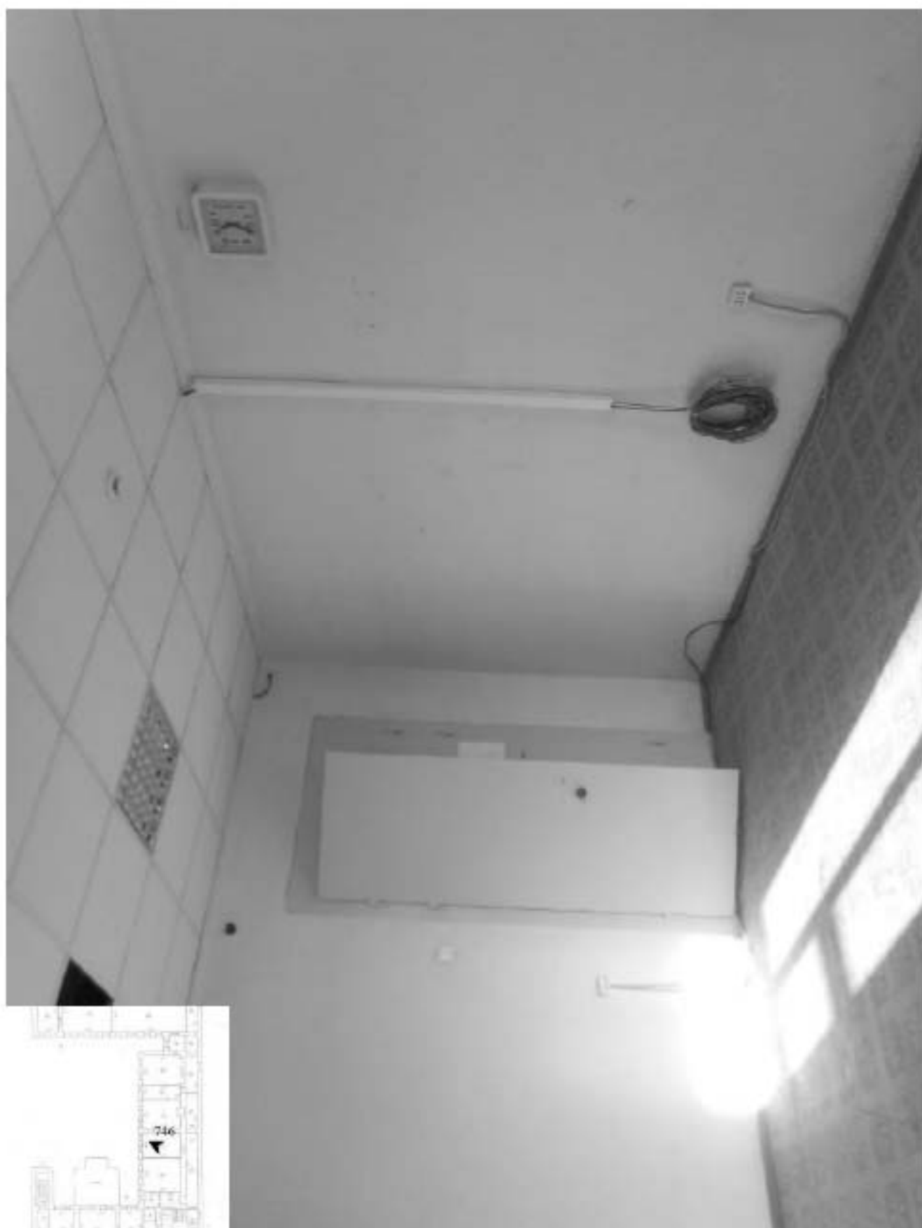
746. Этаж 4, помещение 40-Н. Интерьер комнаты 27,5 кв.м.
