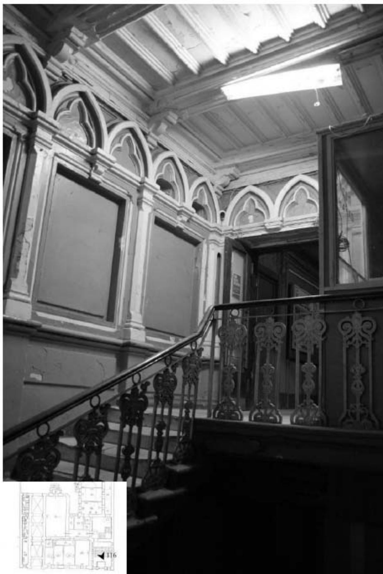
116. Вид на лестничную клетку.
