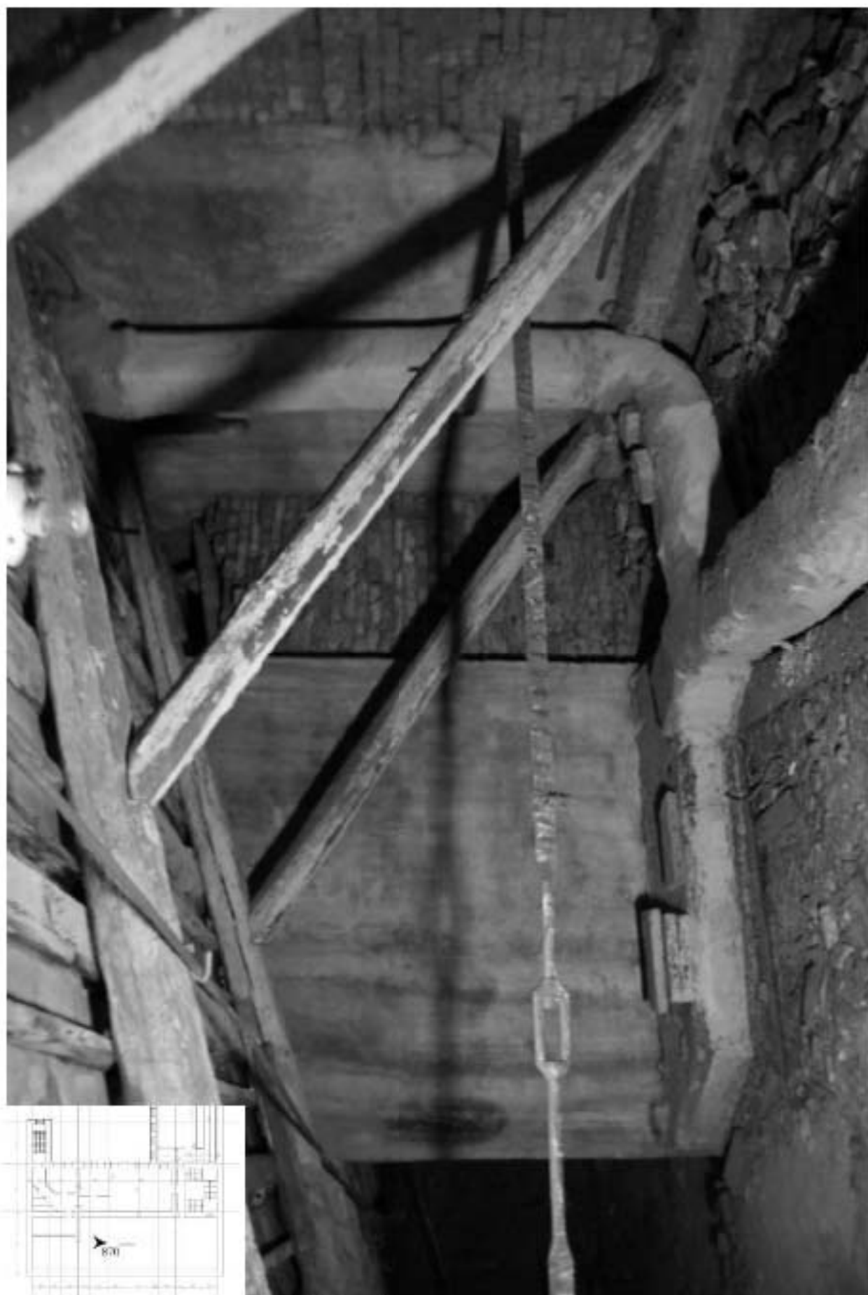
870. Этаж 5, интерьер чердака.
