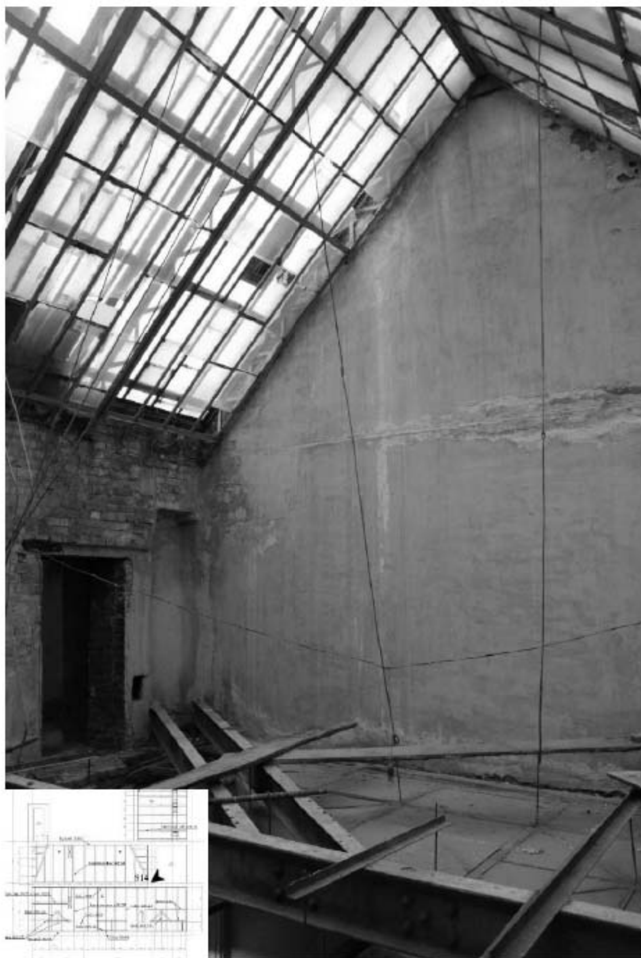
914. Чердак. Вид на конструкции светового фонаря.
