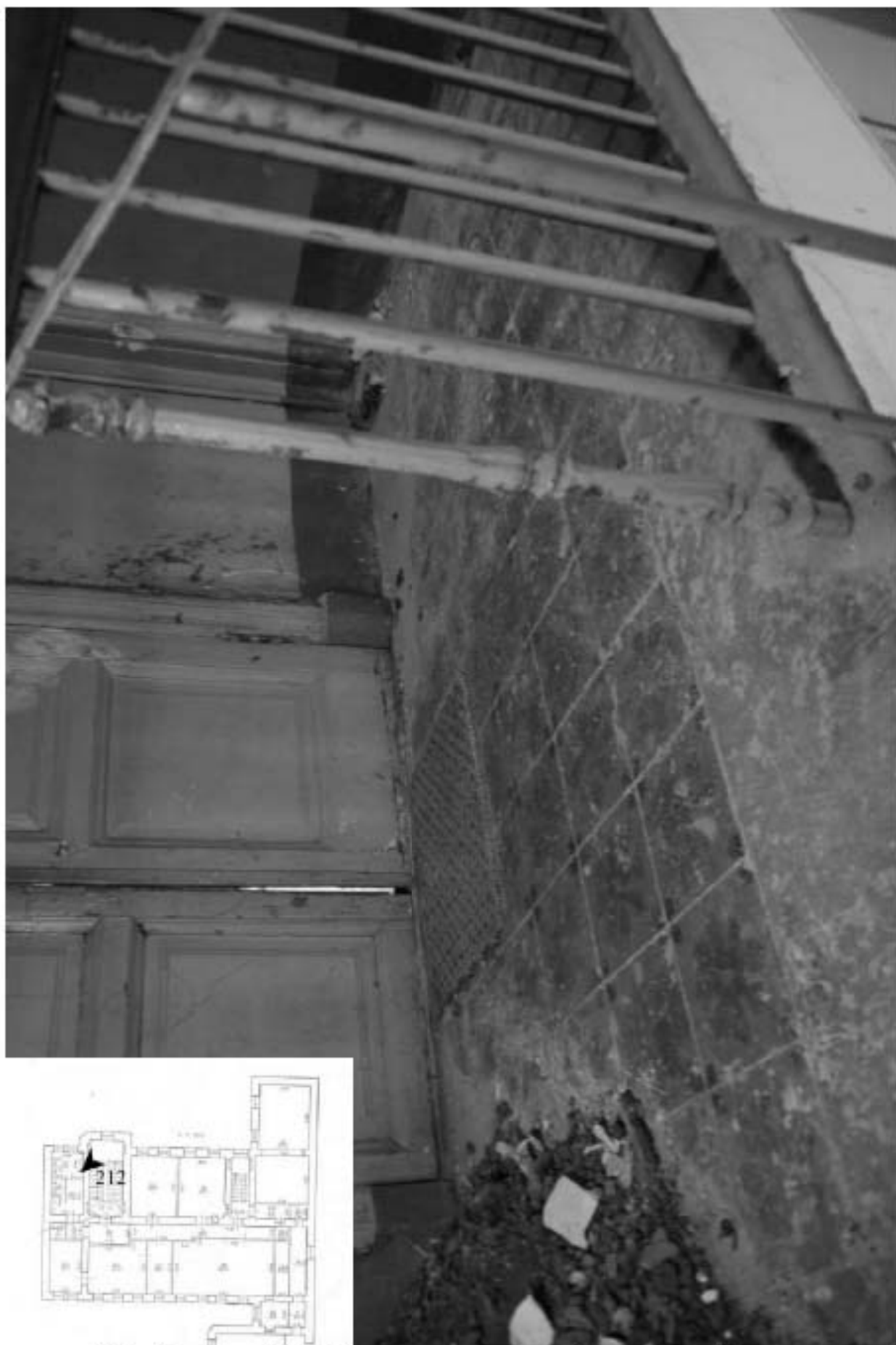
212. Лестница ЗЛК. Покрытие лестничной площадки 5 этажа.
