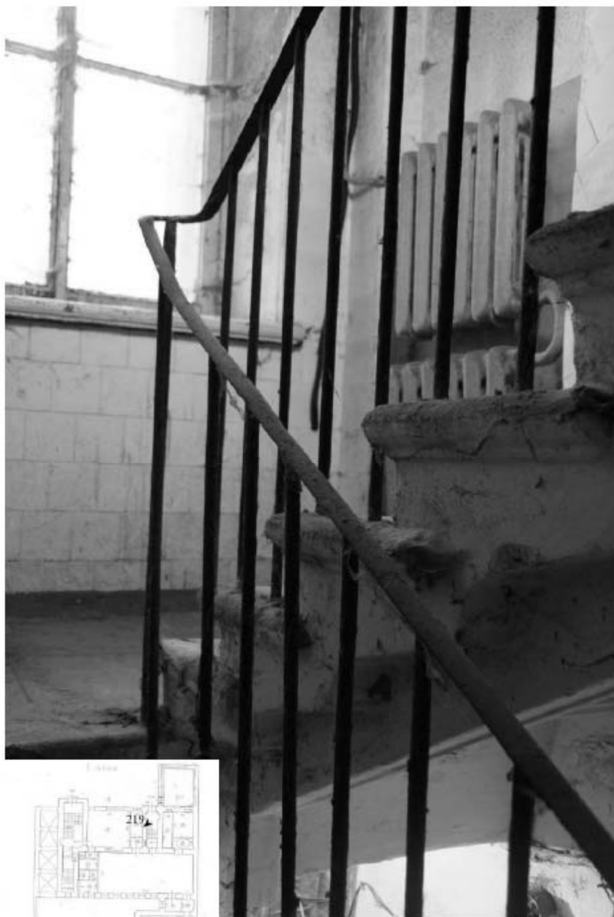
219. Лестница 4ЛК. Вид на лестничную площадку между 1 и 2 этажами.
