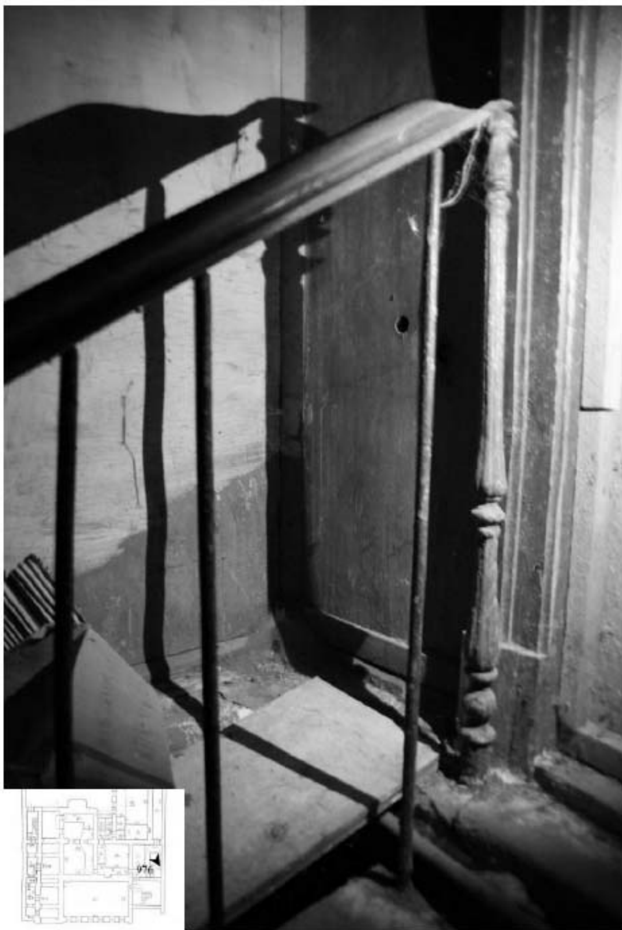
976. Подвал, помещение 6-Н. Ограждение лестницы на 1 этаж.
