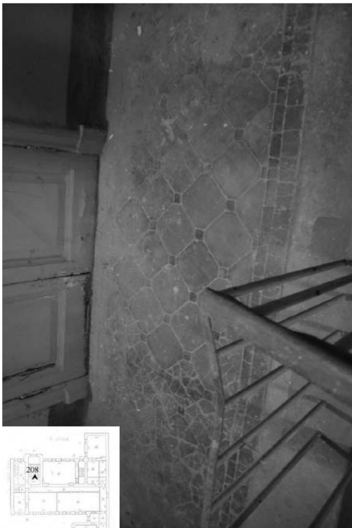
208. Лестница 3ЛК. Покрытие лестничной площадки 4 этажа.
