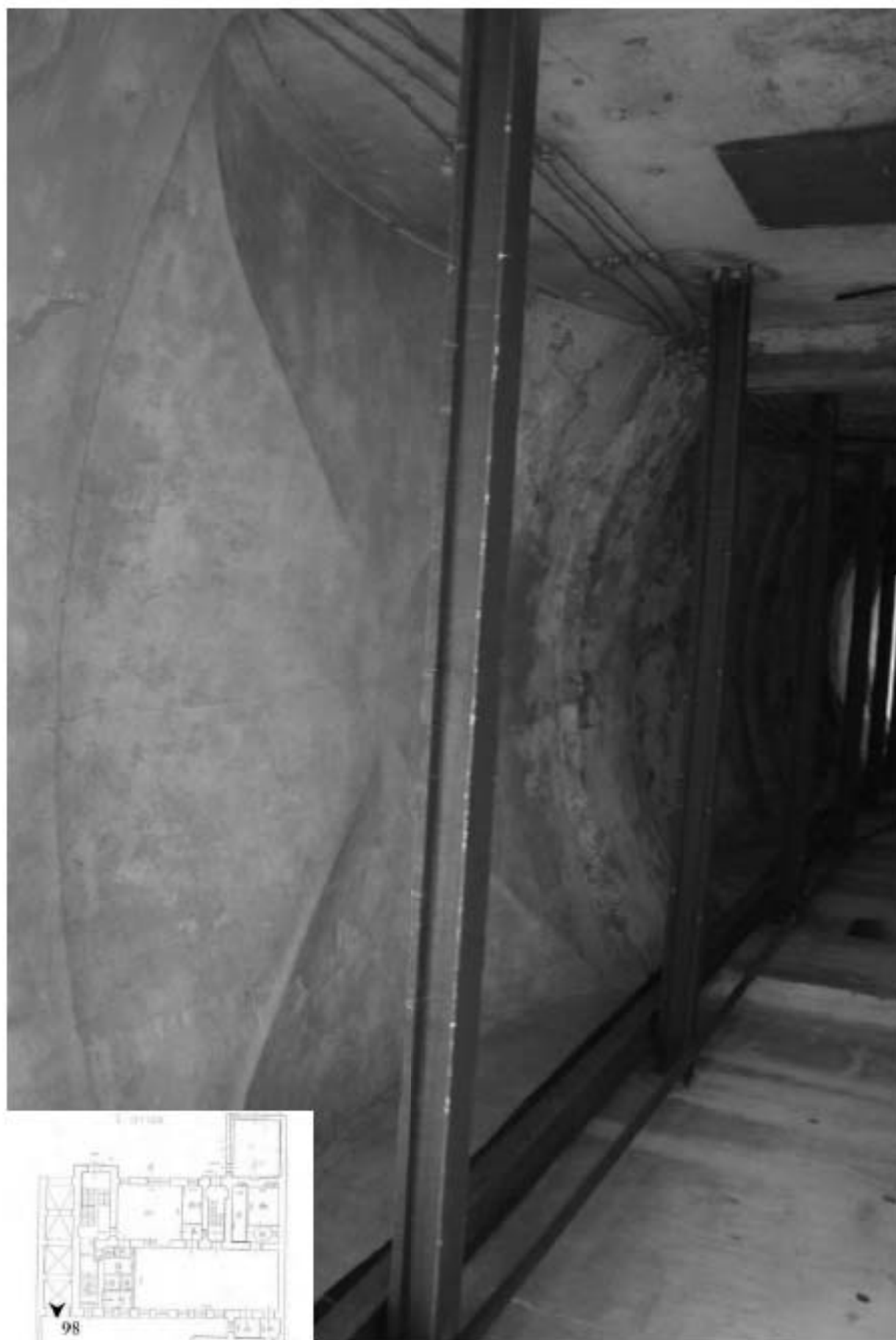
98. Воротный проезд дворового корпуса. Фрагмент.
