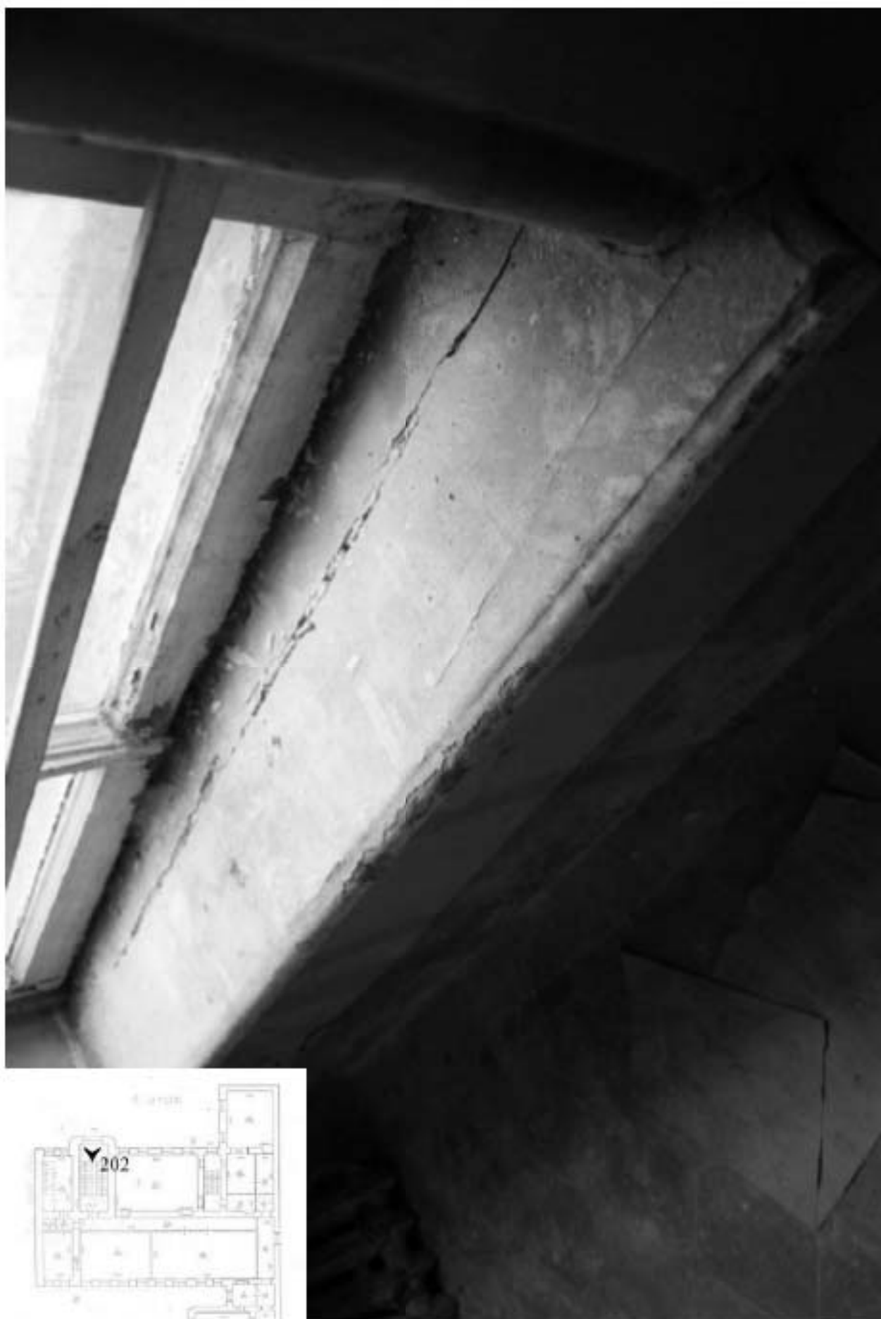
202. Лестница 3ЛК. Деревянный подоконник.
