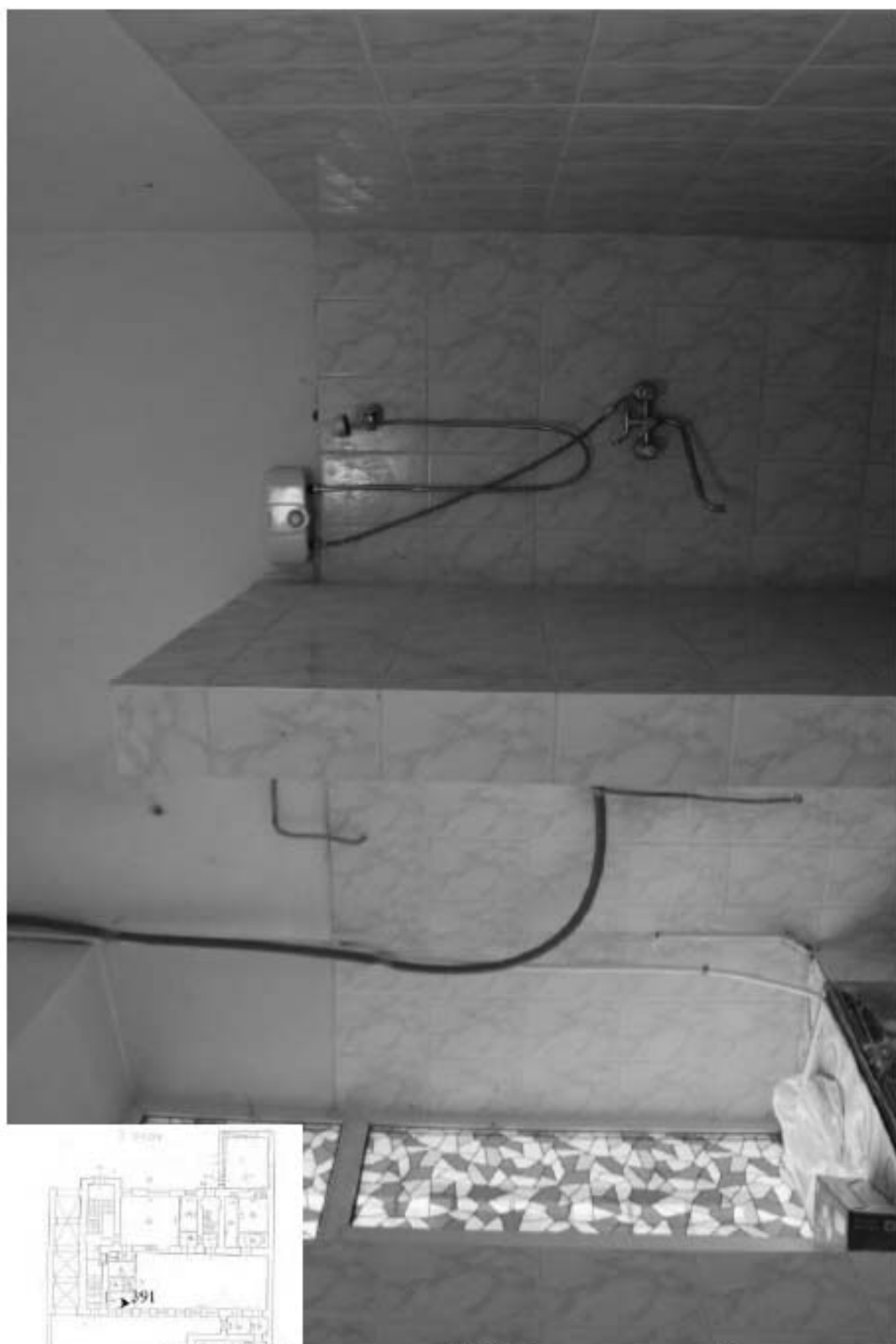
391. Этаж 1, помещение 15-Н. Интерьер душевой.
