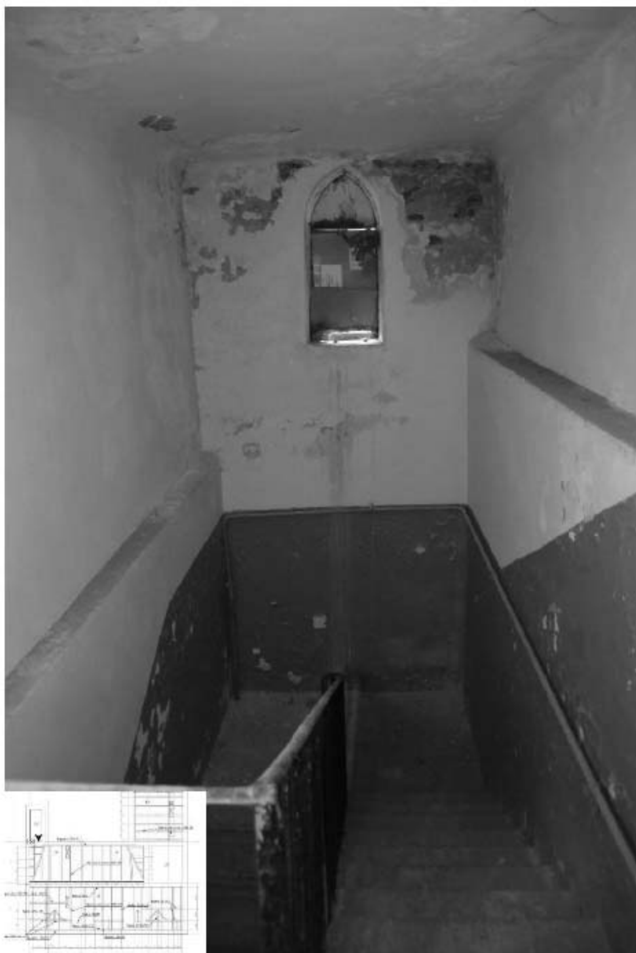
181. Лестница 2ЛК. Лестничная площадка между 5 этажом и чердаком.
