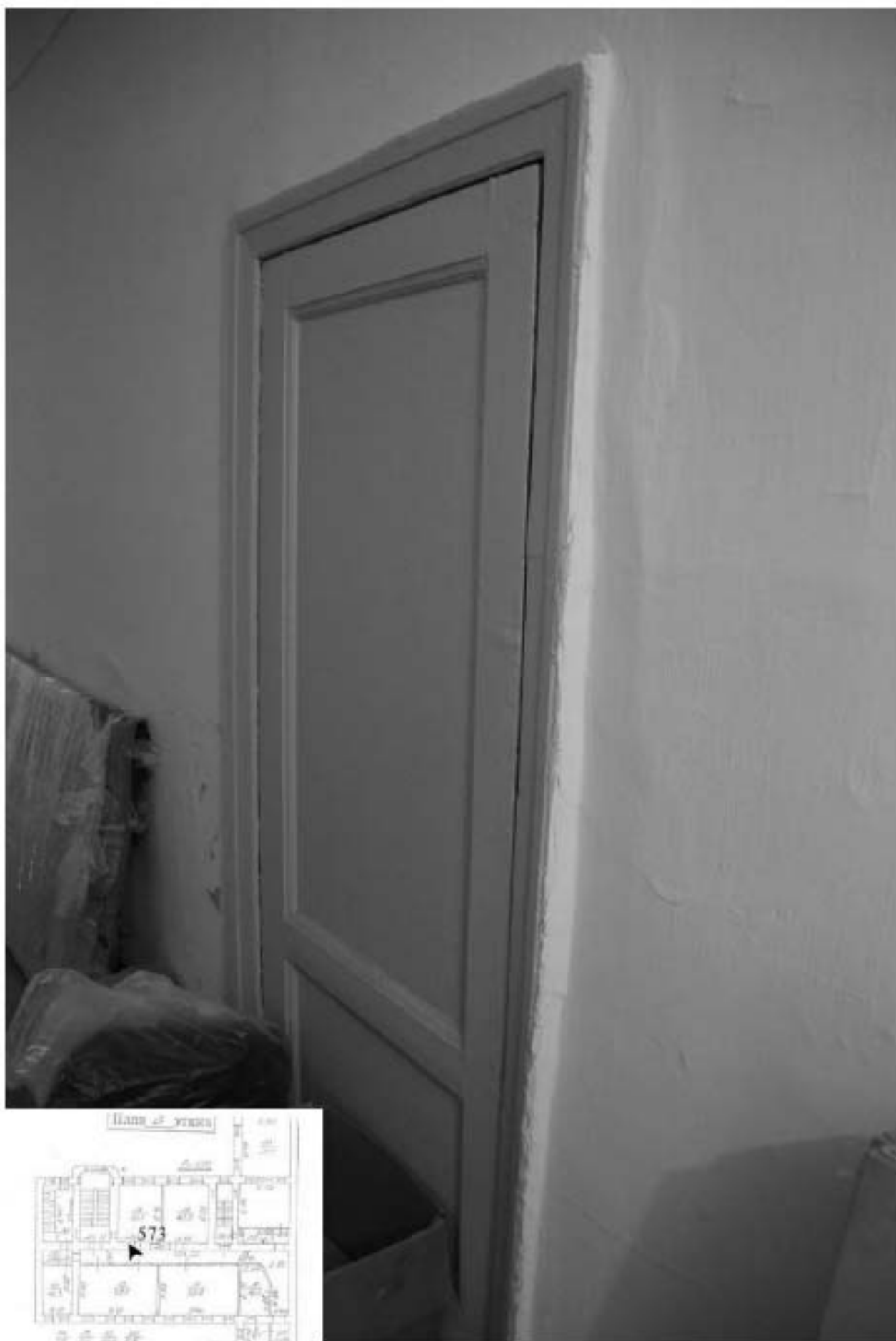
573. Этаж 2, помещение 16-Н. Вид коридора.
