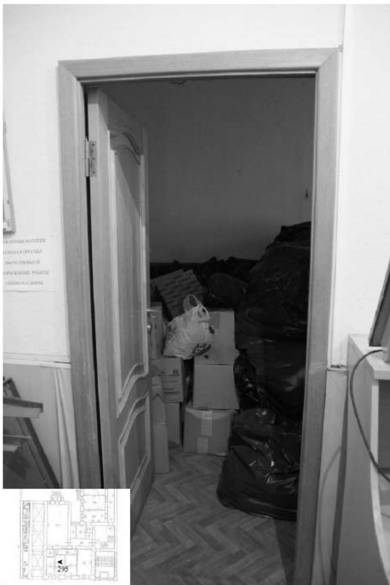
295. Этаж 1, помещение 20-Н. Вид на входную дверь комнаты 19,2 кв.м.
