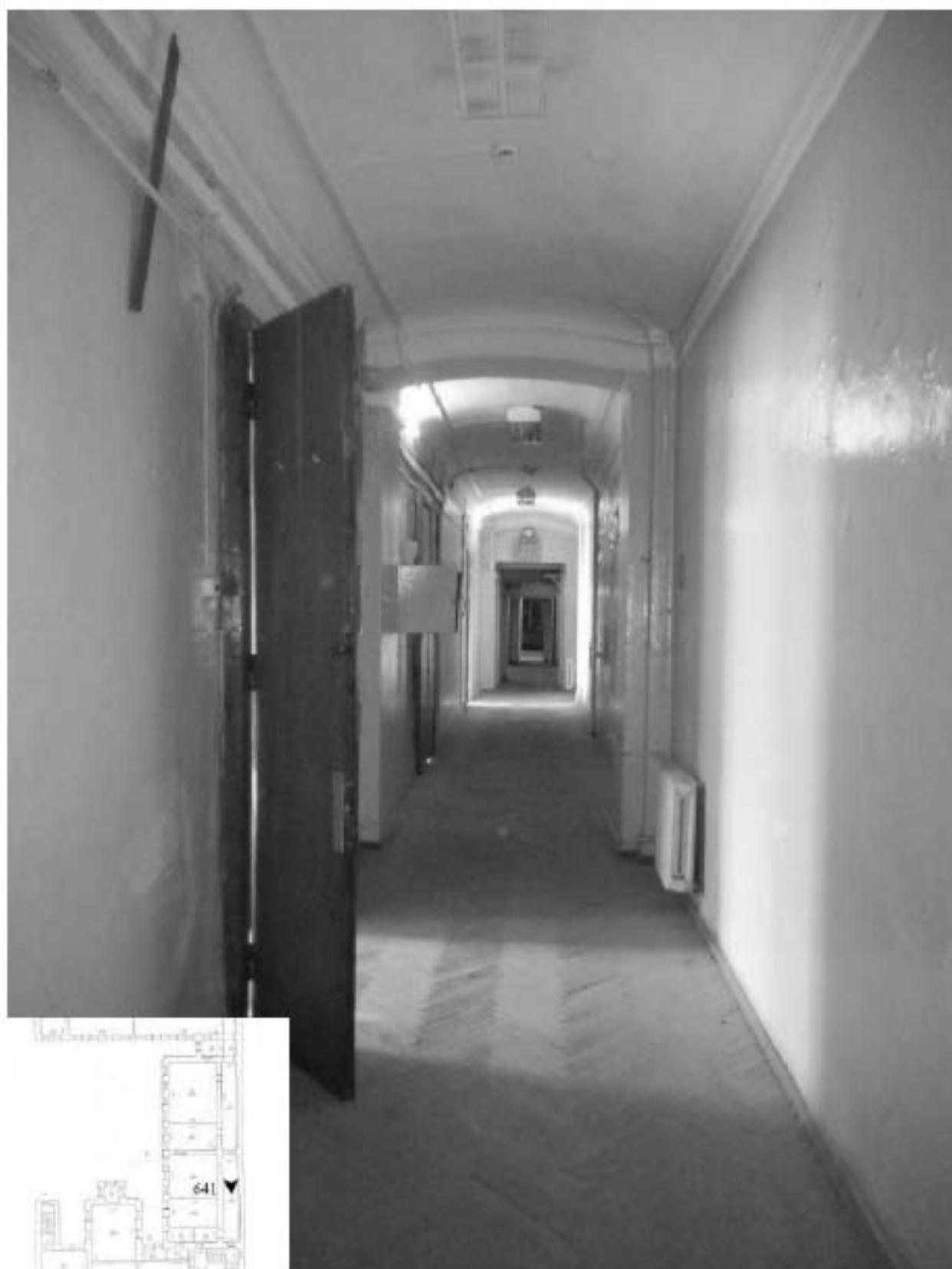
641. Этаж 3, помещение 17-Н. Вид коридора.
