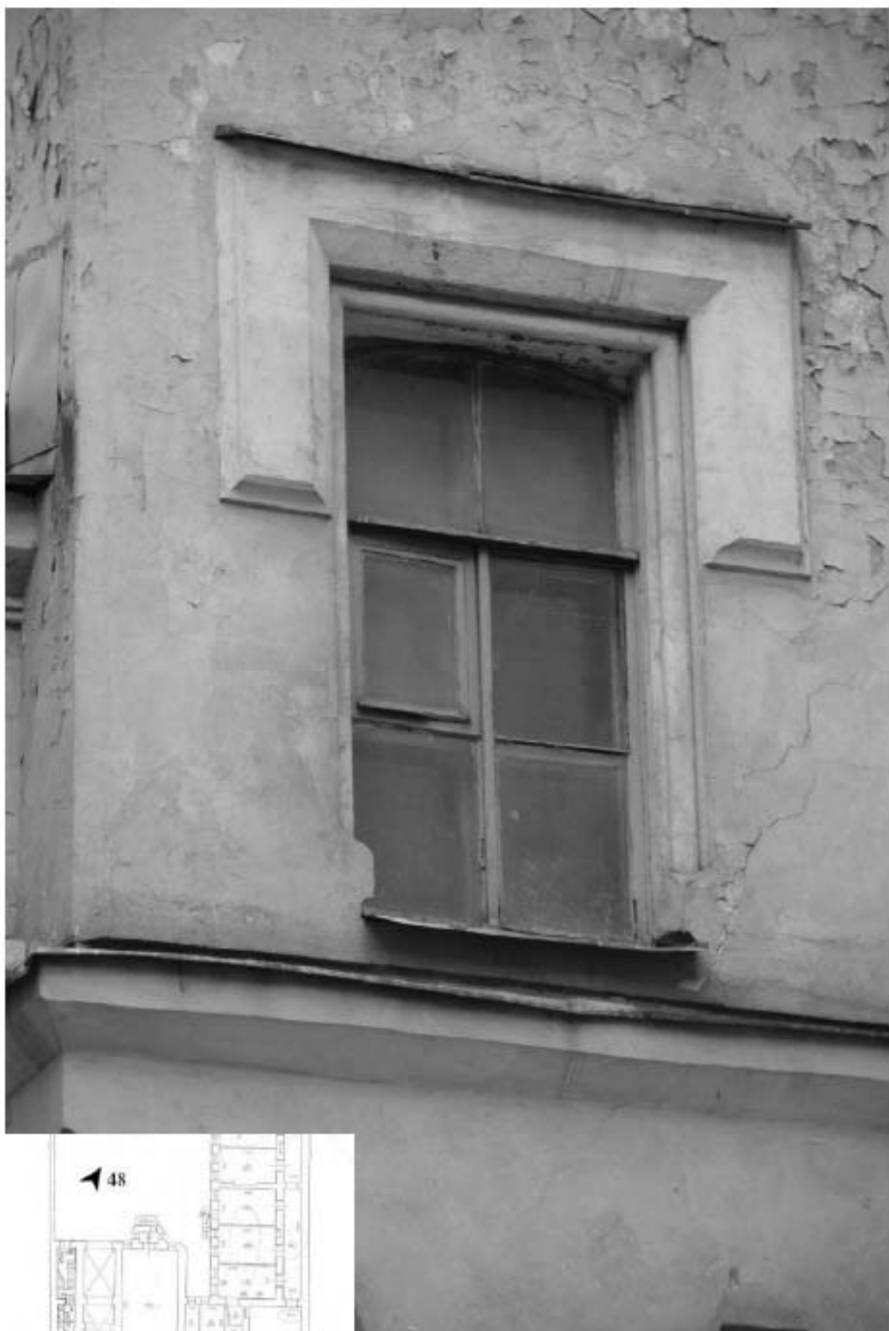
48. Фрагмент дворового фасада лицевого корпуса.
