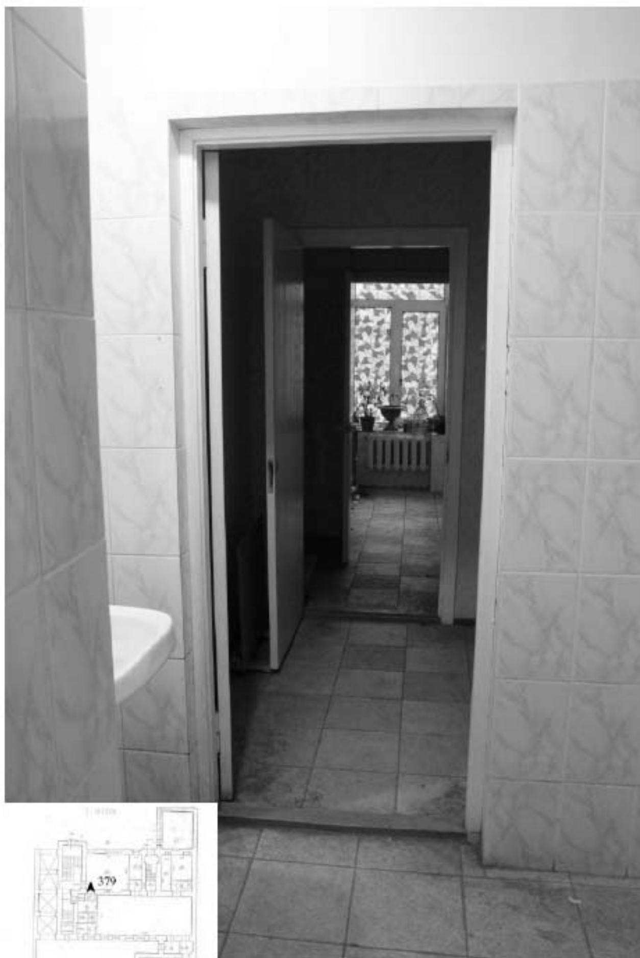
379. Этаж 1, помещение 15-Н. Интерьер душевой.
