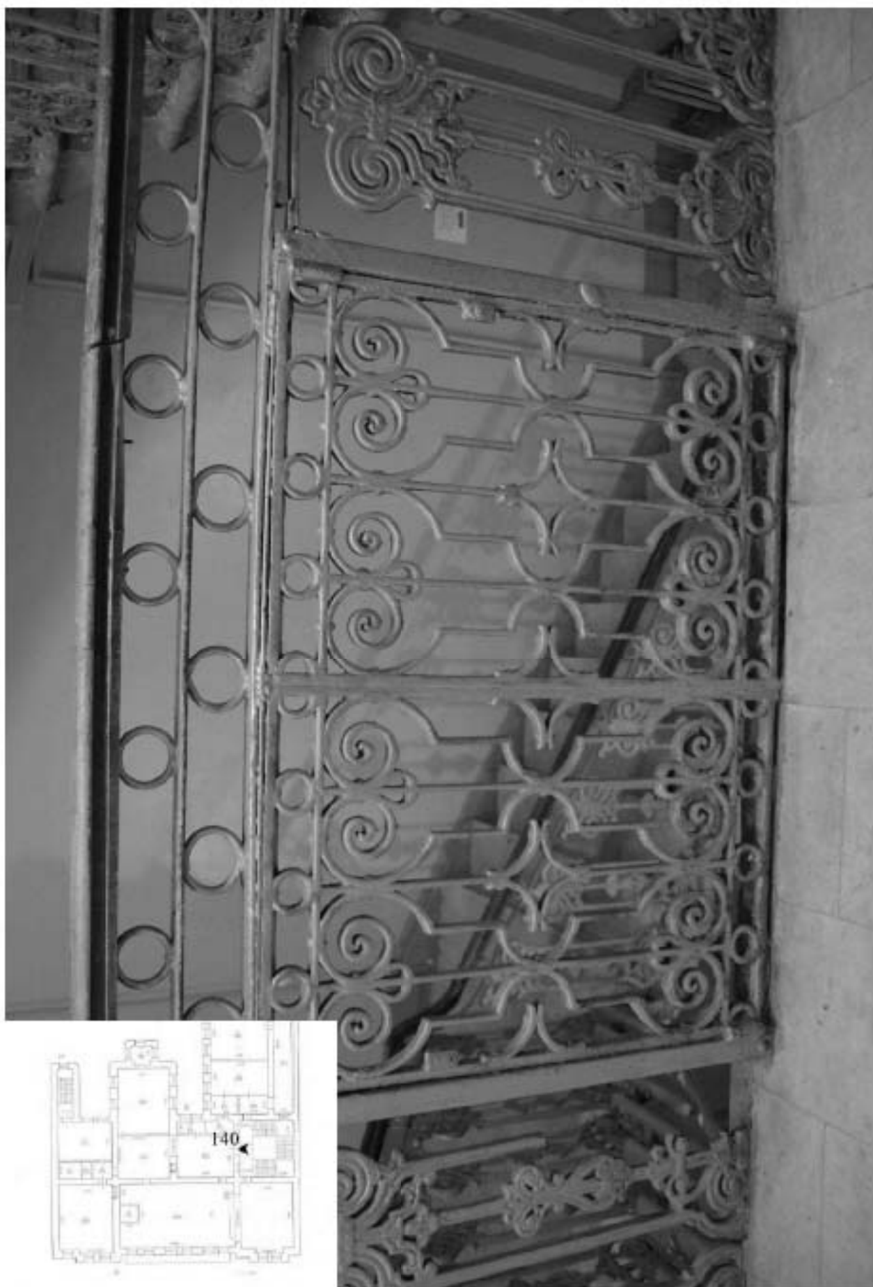
140. Створки ограждения лестничной площадки 2 этажа.
