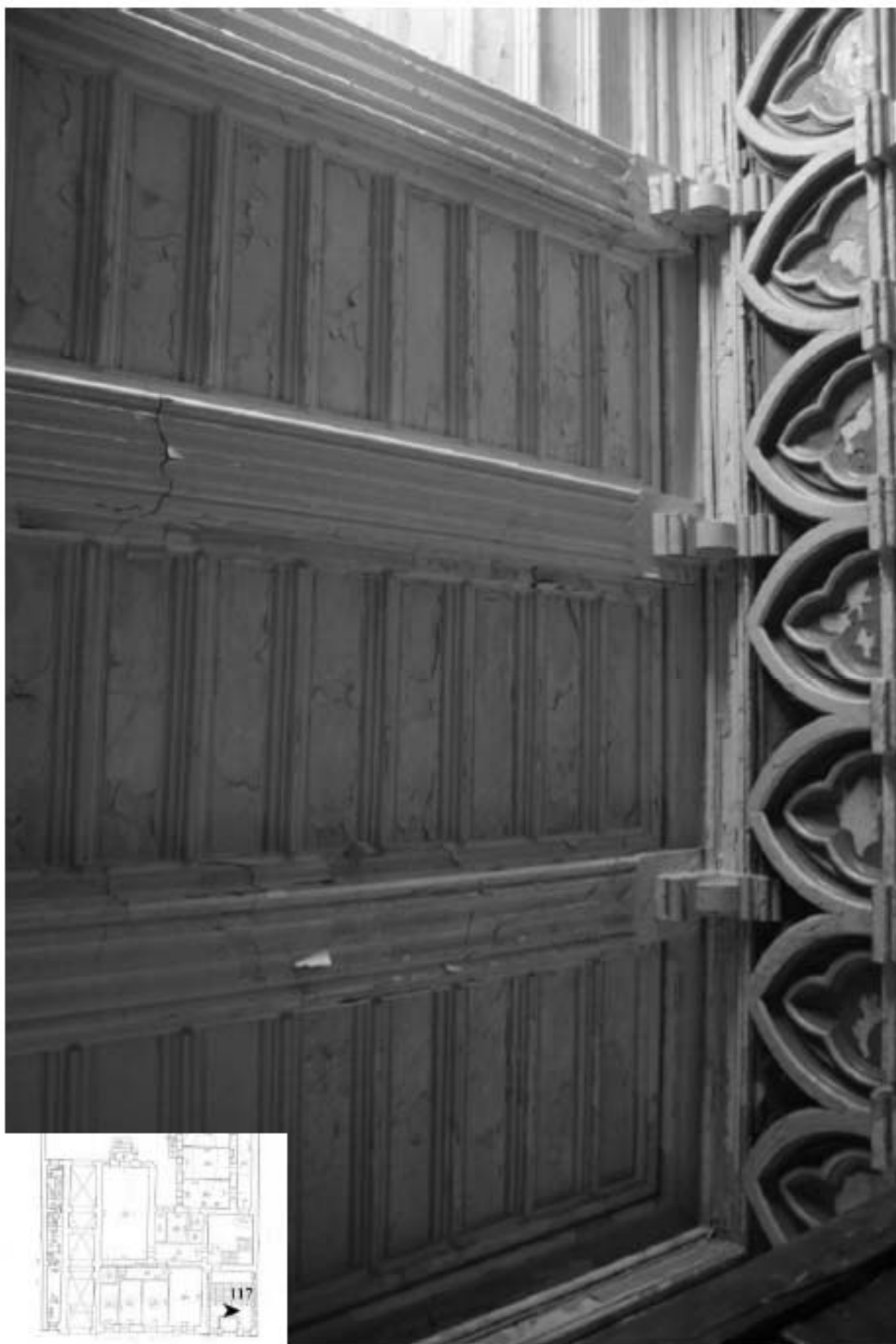
117. Оформление потолка пространства перед парадным входом.
