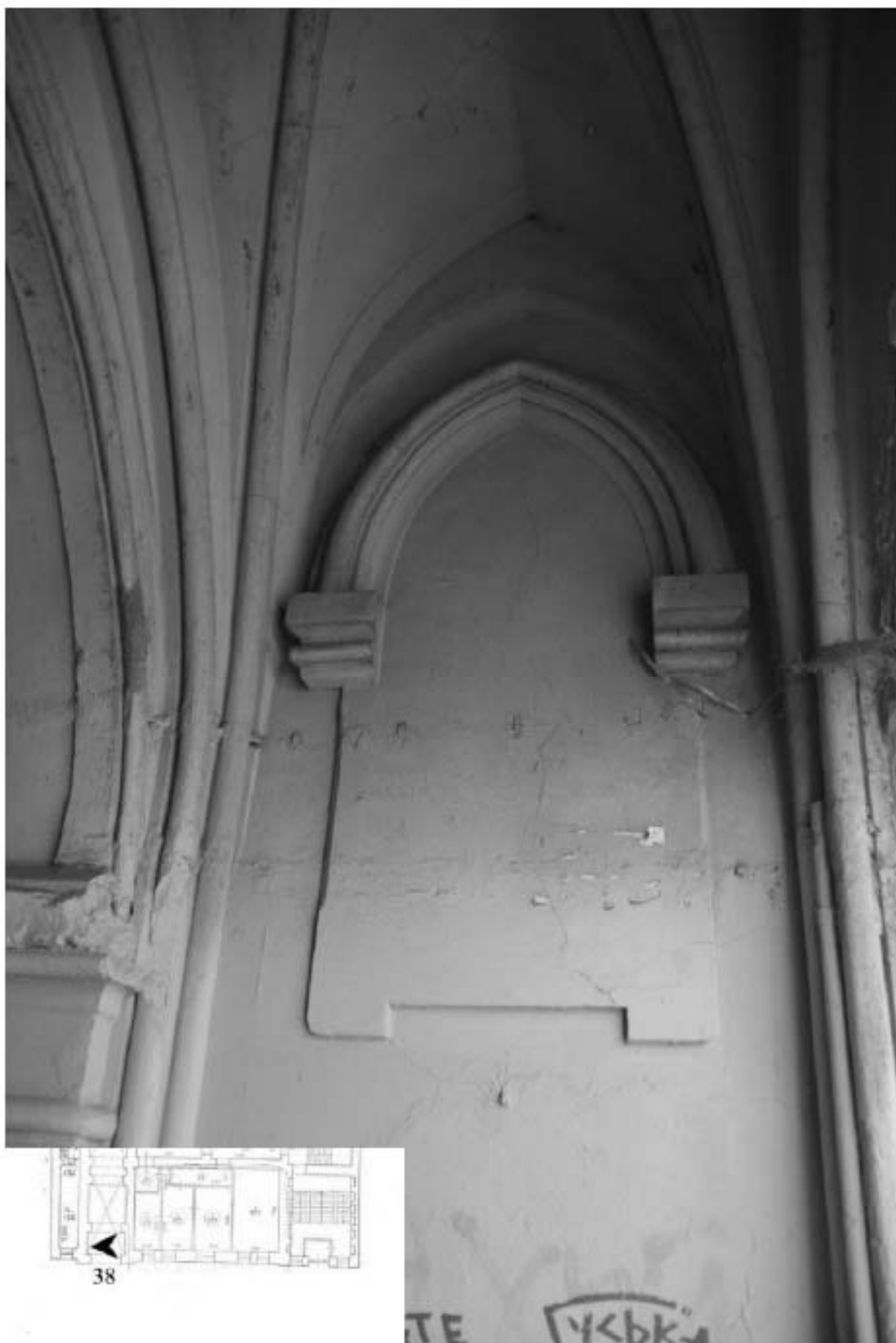
38. Фрагмент проездной арки.
