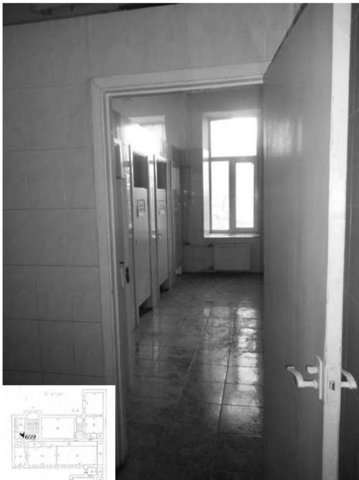
699. Этаж 3, помещение 17-Н. Интерьер комнаты 14,3 кв.м.
