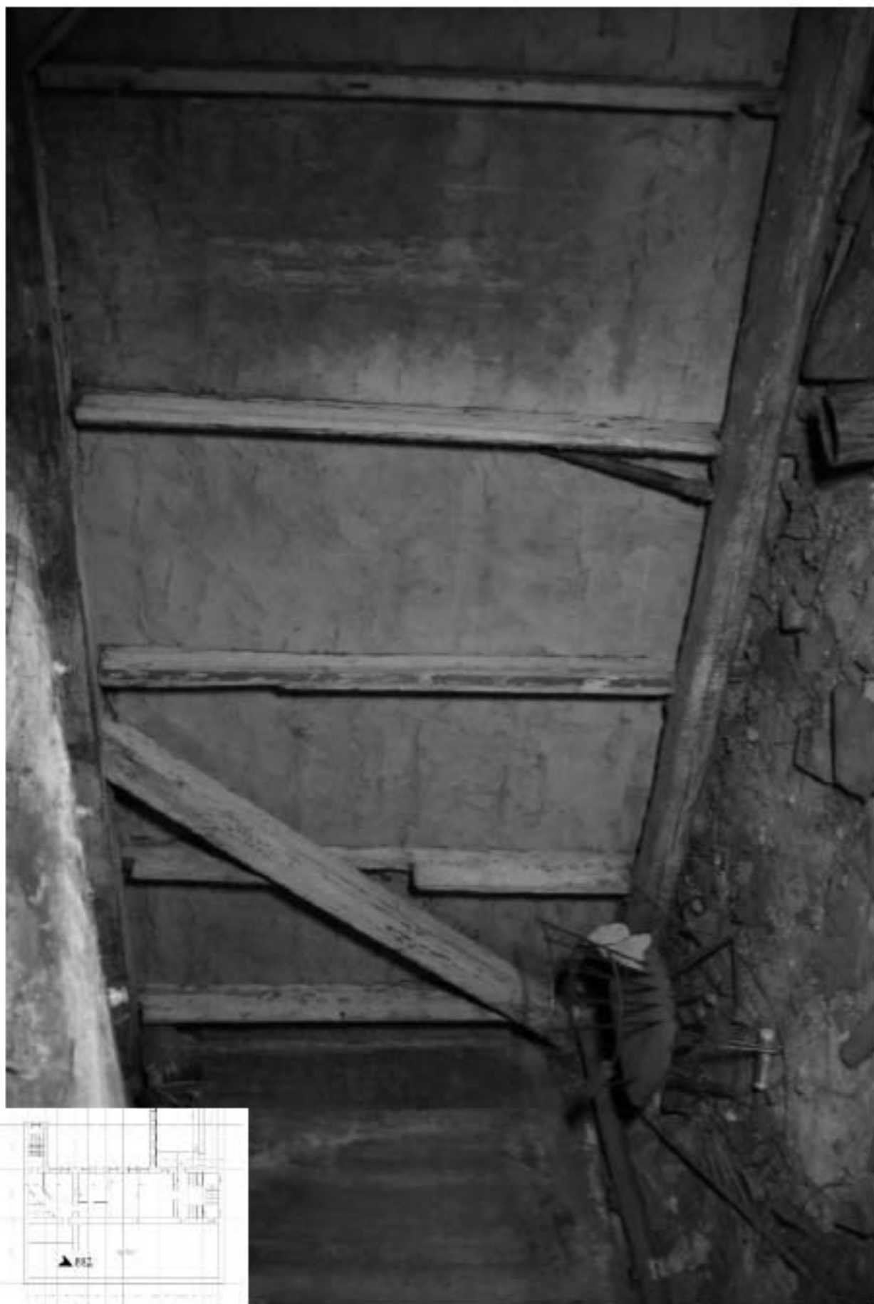
882. Этаж 5, интерьер чердака.
