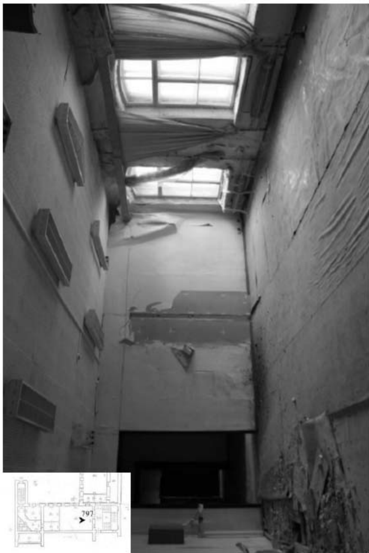
797. Этаж 5, помещение 31-Н. Интерьер комнаты 60,3 кв.м.
