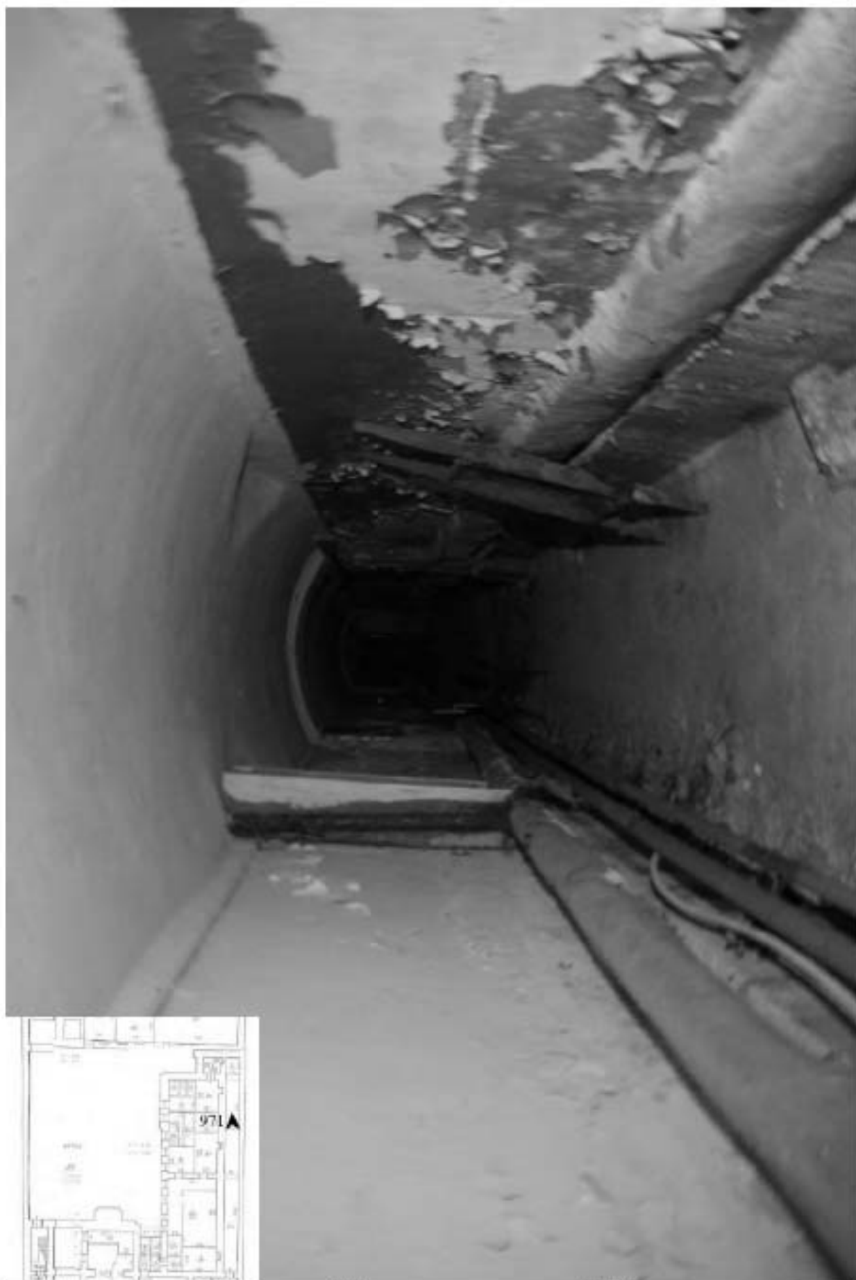
971. Подвал. Интерьер помещения 29-Н.
