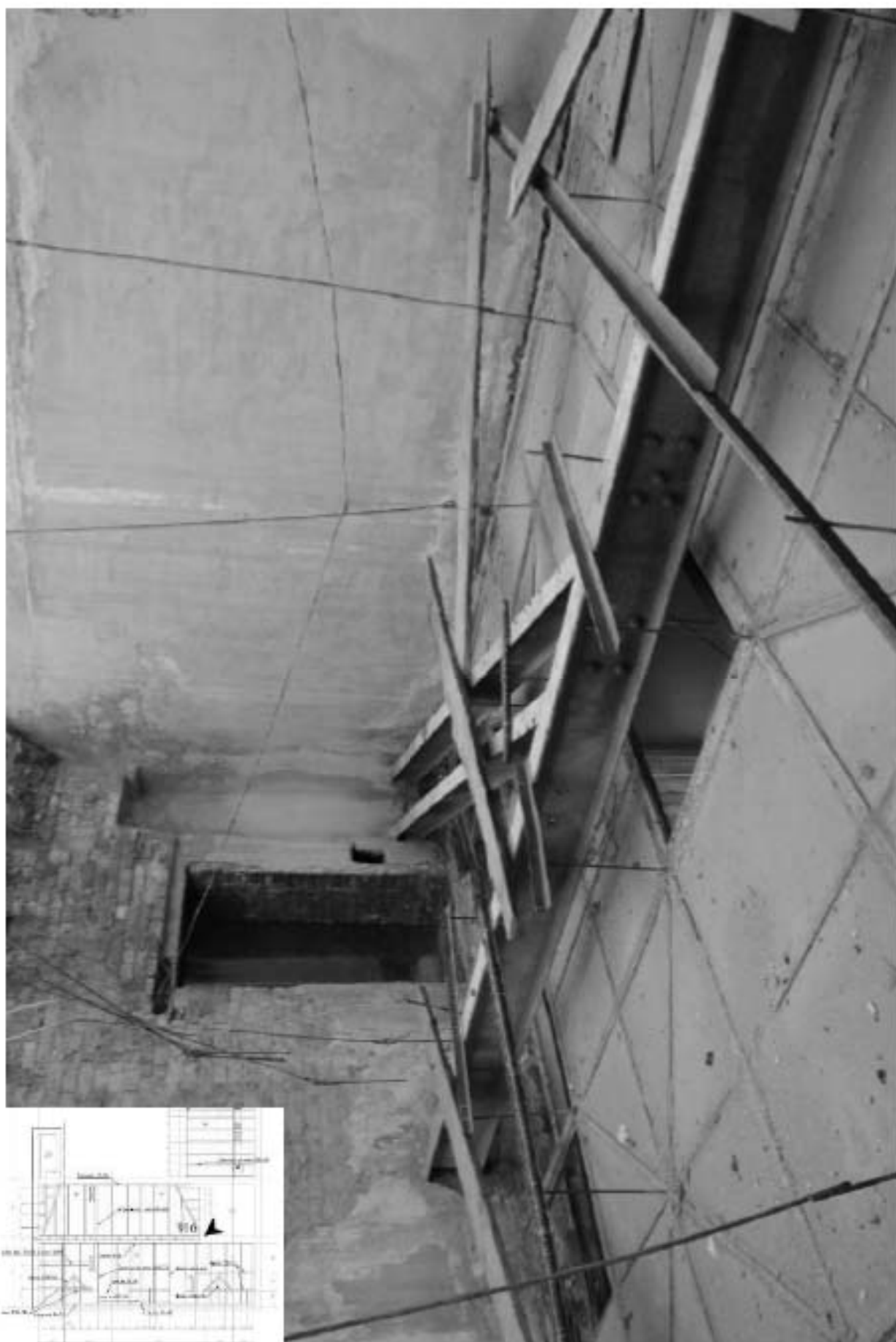
916. Чердак. Вид на конструкции светового фонаря.
