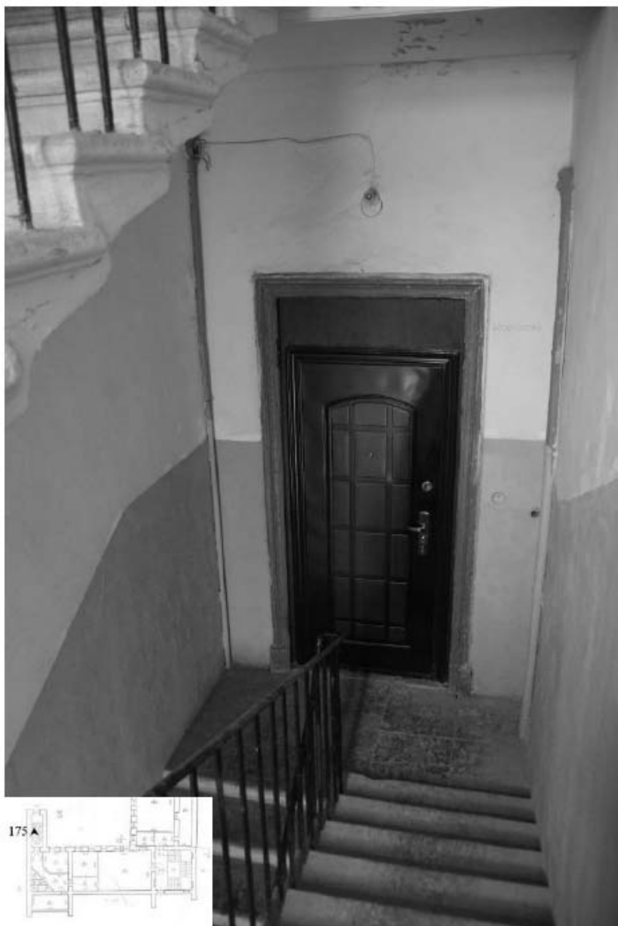
175. Лестница 2ЛК. Вид на лестничную площадку 4 этажа.
