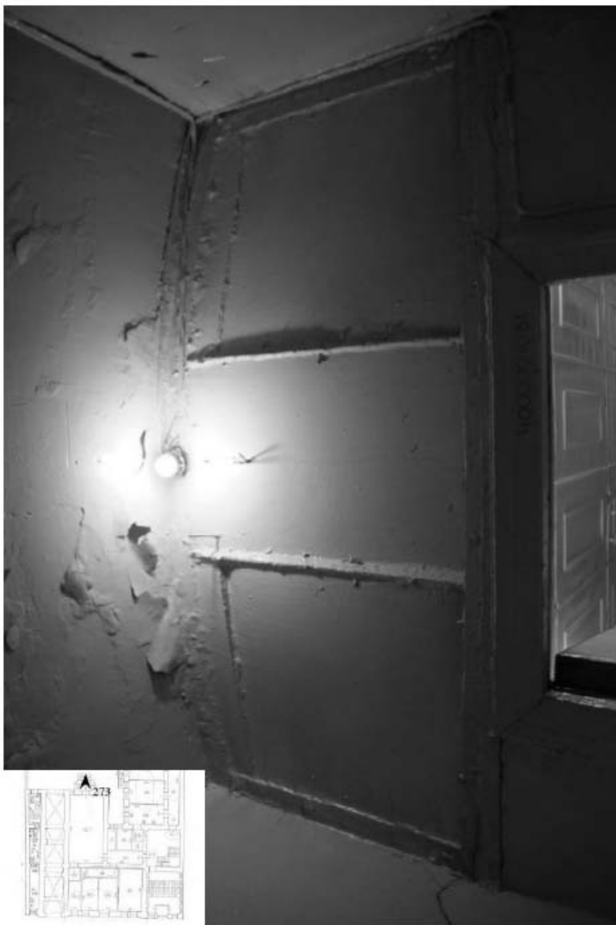
23. Этаж 1, помещение 20-Н. Интерьер входной группы.
