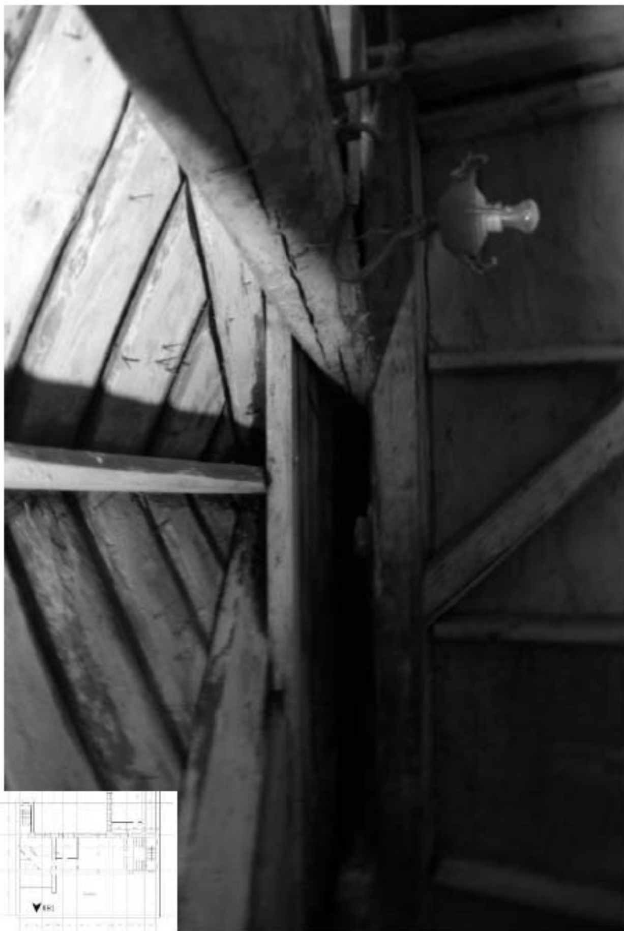
881. Этаж 5, интерьер чердака.
