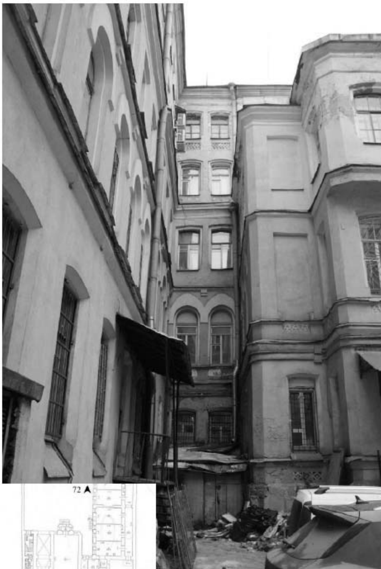
72. Фрагмент дворового фасада лицевого корпуса.
