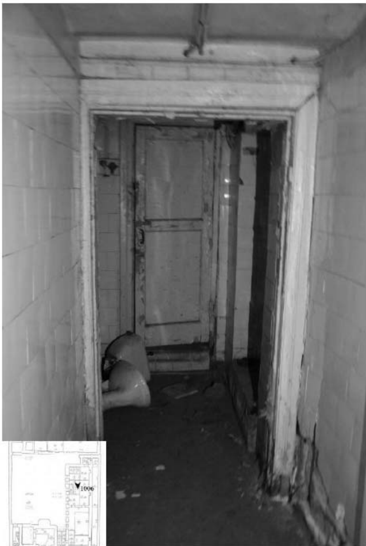
1006. Подвал, помещение 6-Н. Вид на вход в комнату 5,9 кв.м.
