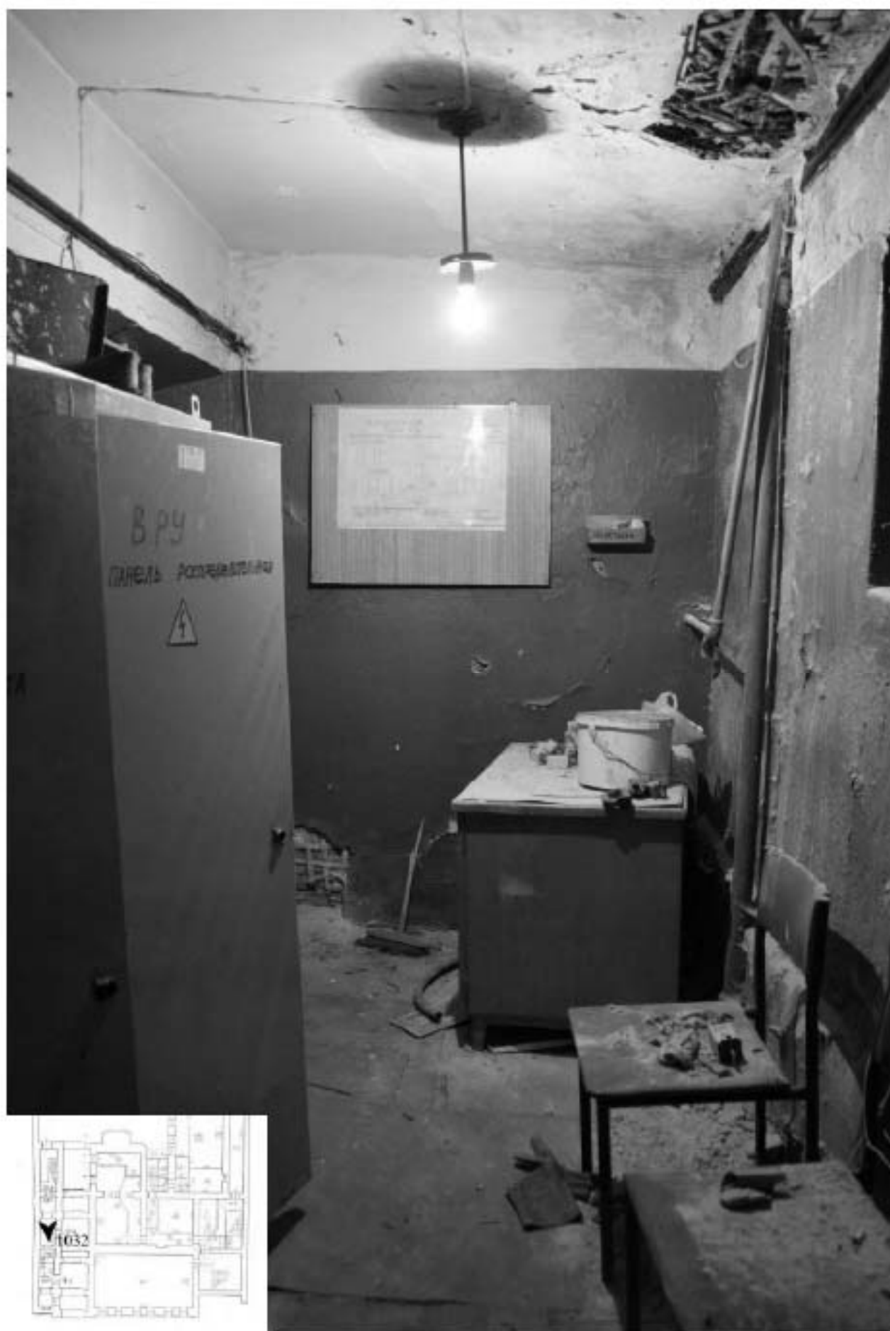
1032. Подвал, интерьер помещения 10-Н.
