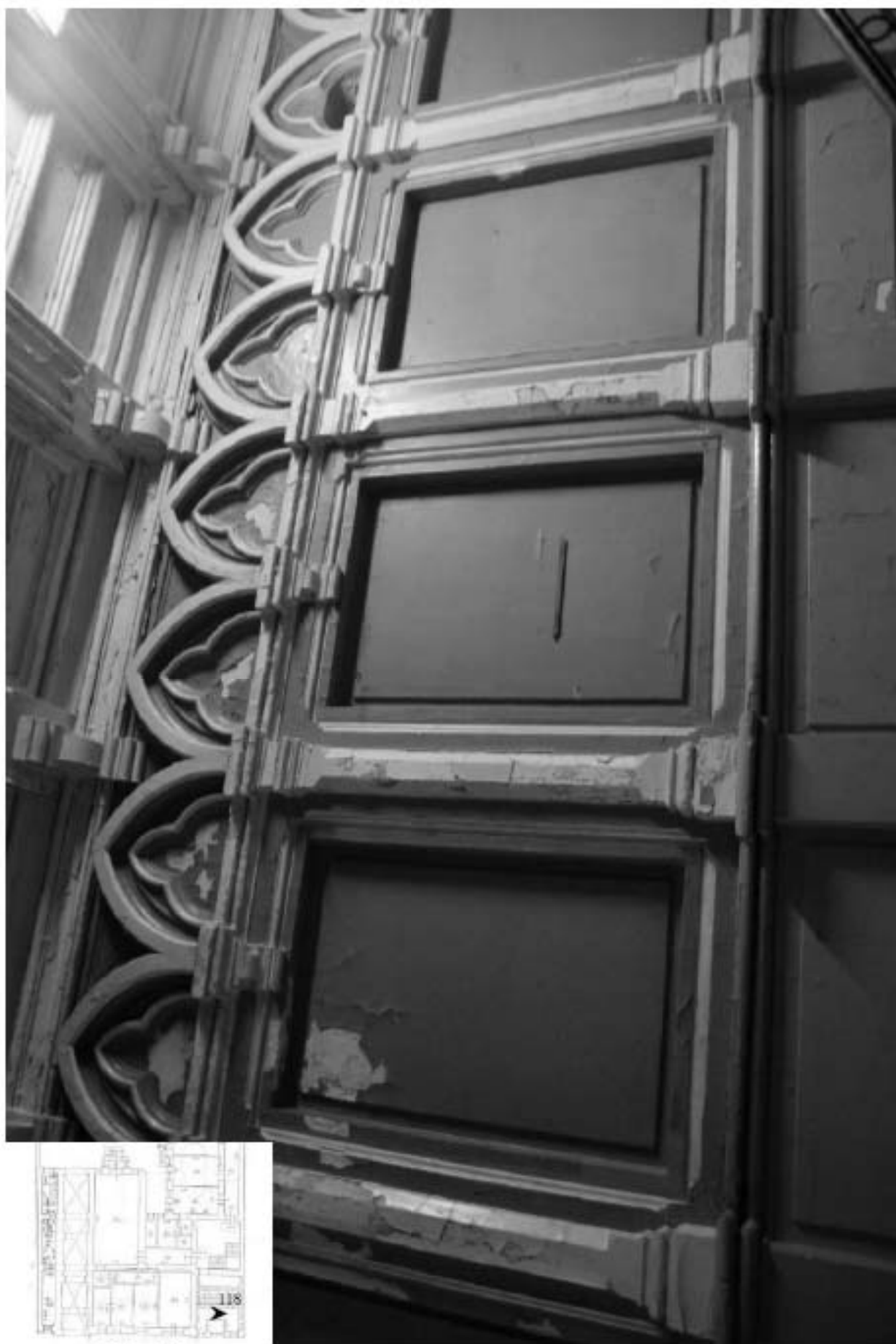
118. Оформление стен пространства перед парадным входом.
