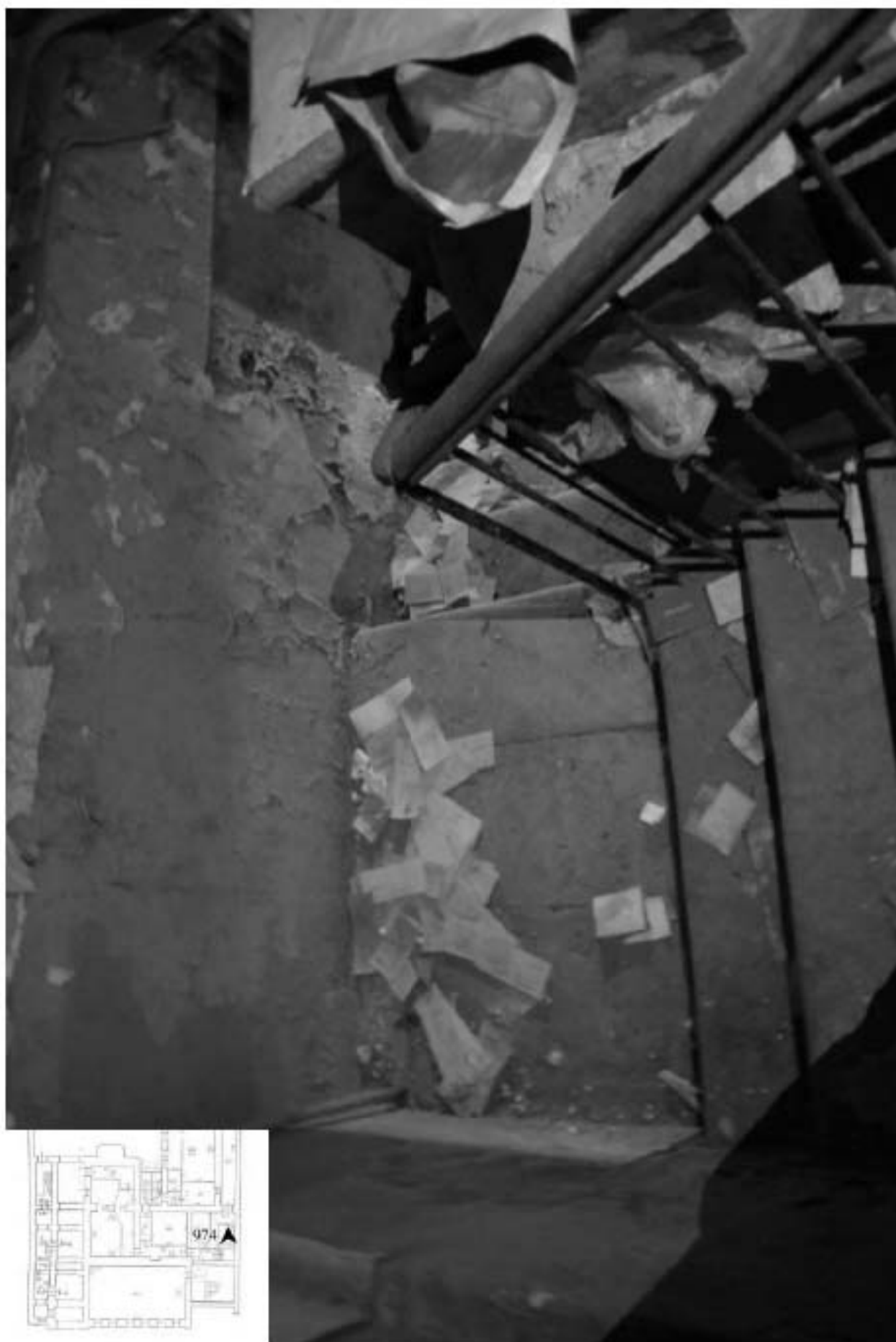
974. Подвал, помещение 6-Н. Интерьер лестницы на 1 этаж.
