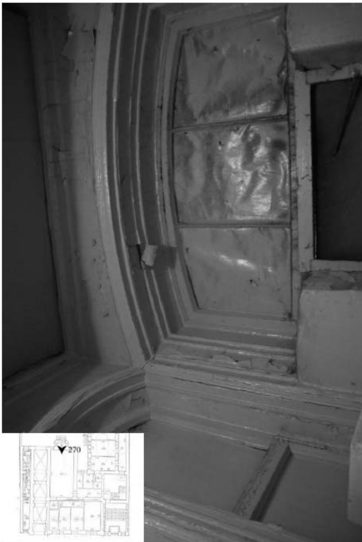
270. Этаж 1, помещение 20-Н. Интерьер входной группы.
