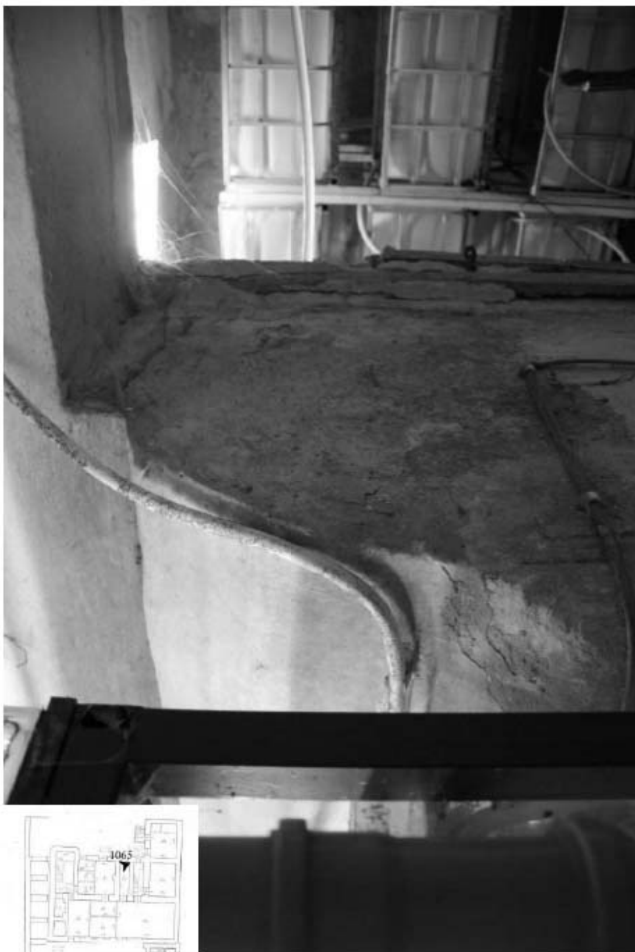
1065. Подвал, помещение 2-Н. Вид входного проёма в комнату 20,1 кв.м.
