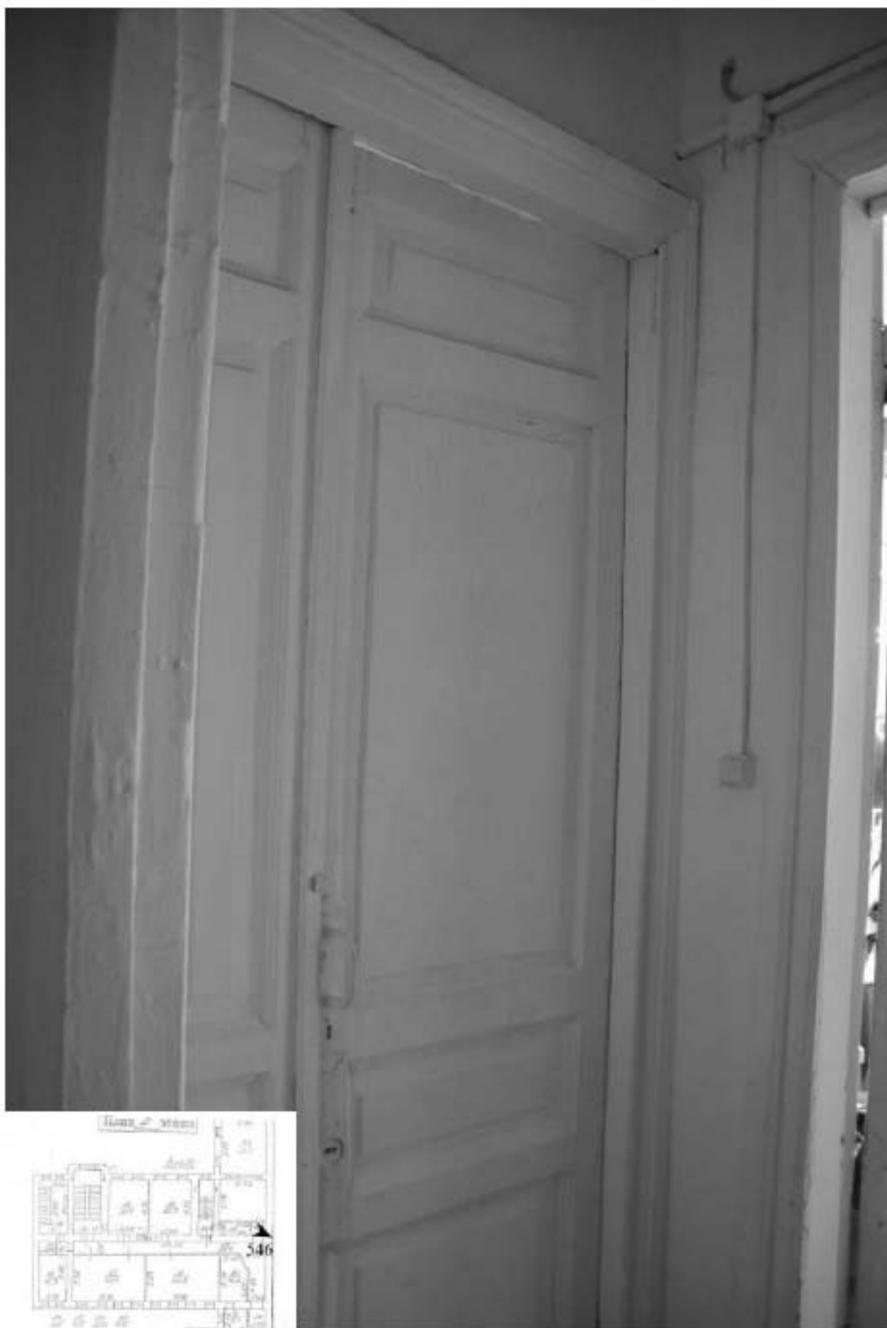
546. Этаж 2, помещение 16-Н. Дверь комнаты 22.
