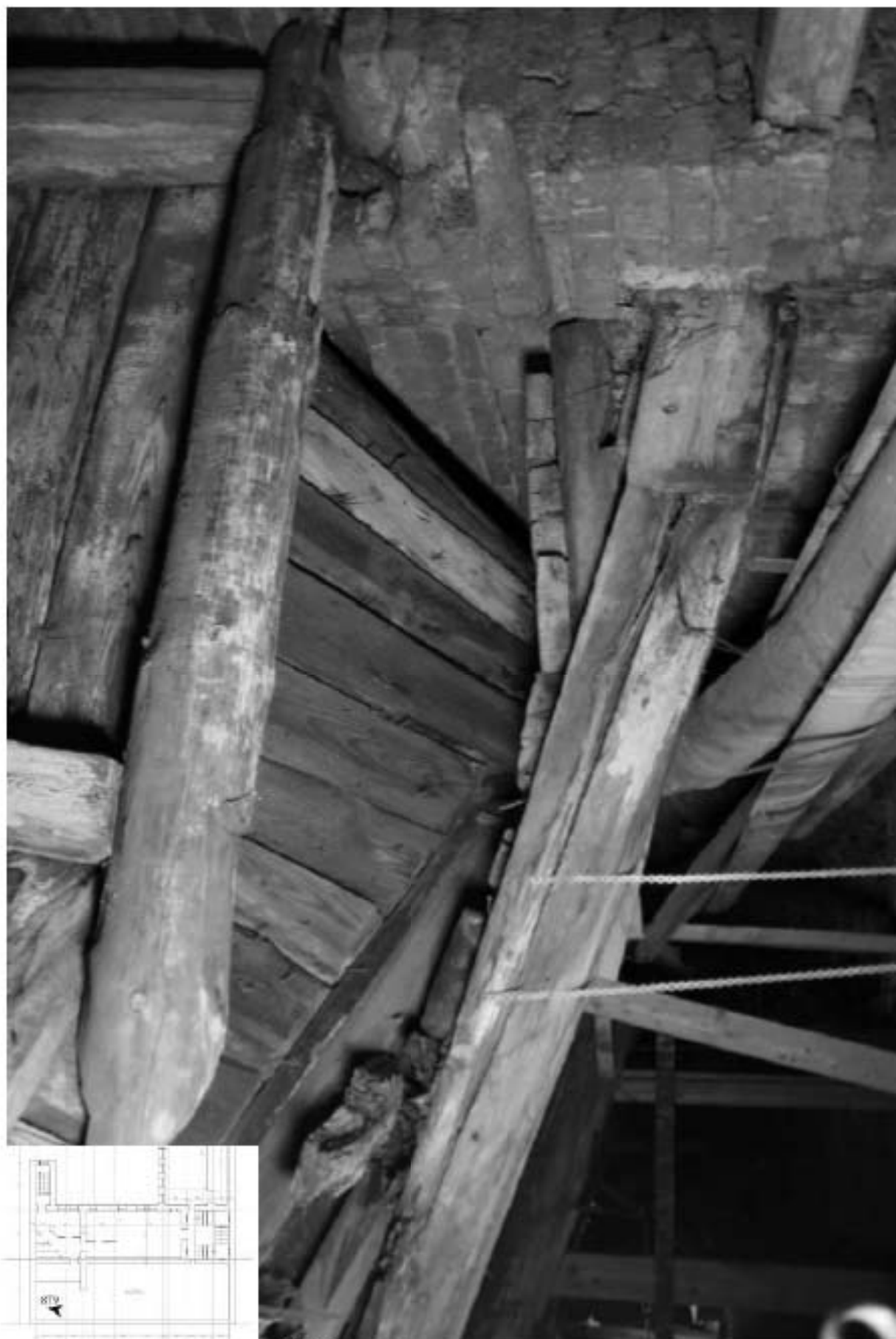
879. Этаж 5, интерьер чердака.
