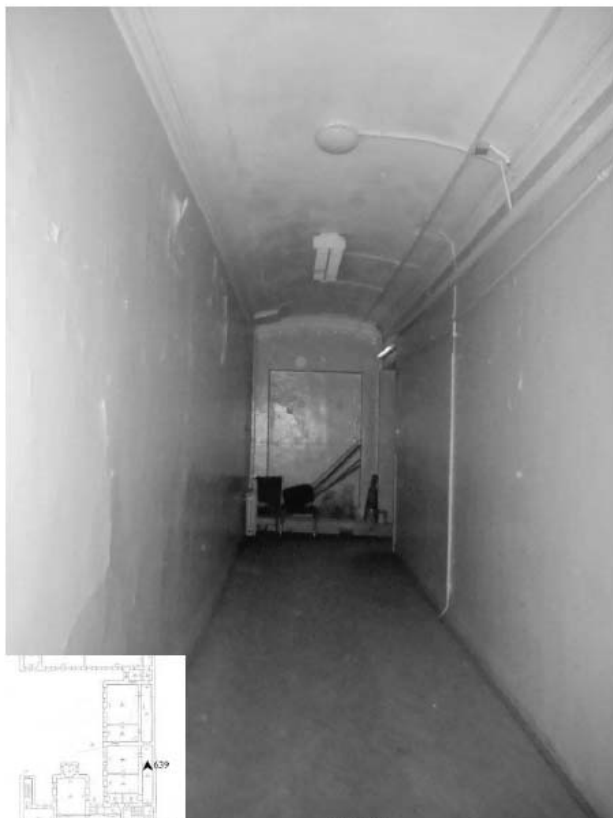
639. Этаж 3, помещение 17-Н. Вид коридора.
