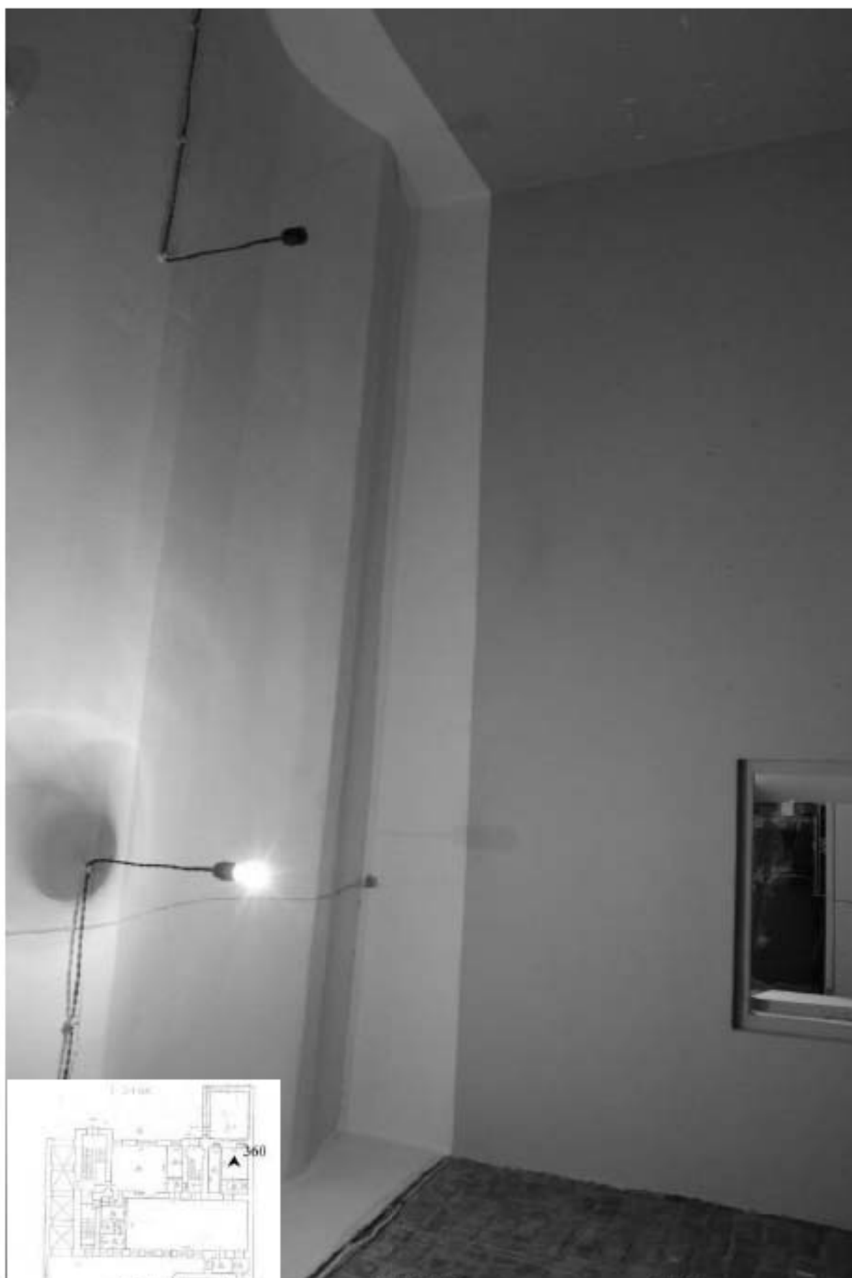
360. Этаж 1, помещение 15-Н. Интерьер комнаты 17,0 кв.м.
