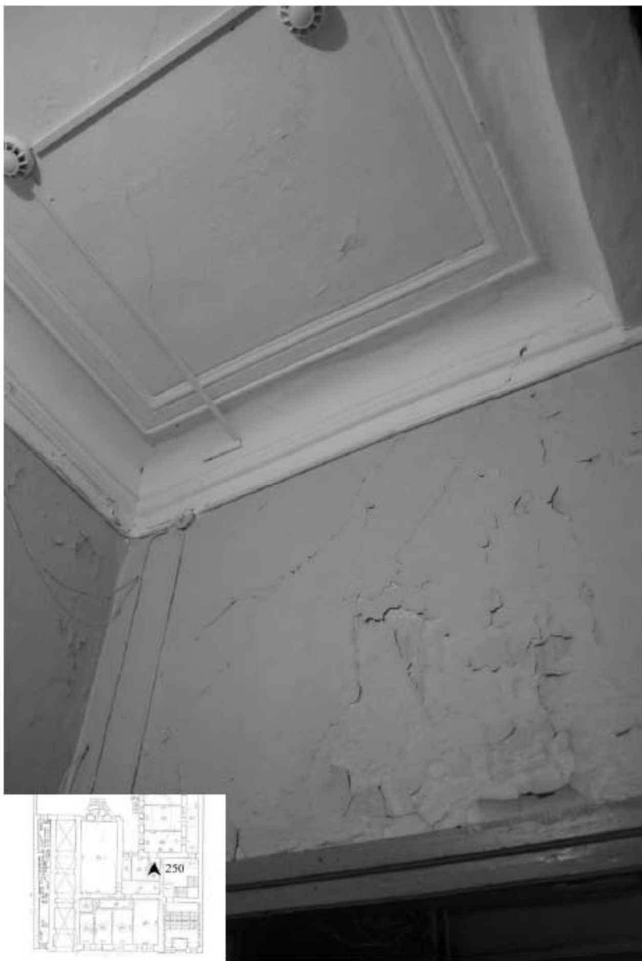
250. Этаж 1, помещение 20-Н. Потолок комнаты 3,6 кв.м.
