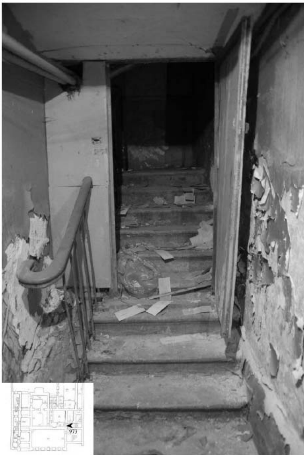
973. Подвал, помещение 6-Н. Лестница на 1 этаж.
