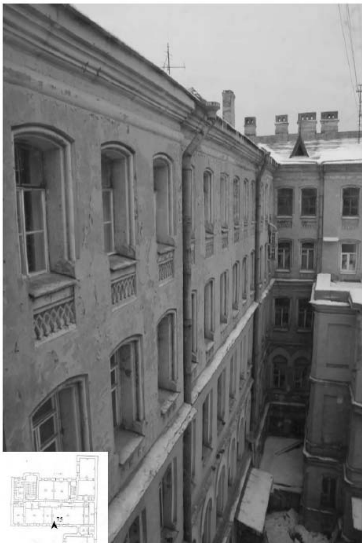
75. Вид на дворовые фасады из окон 5 этажа.
