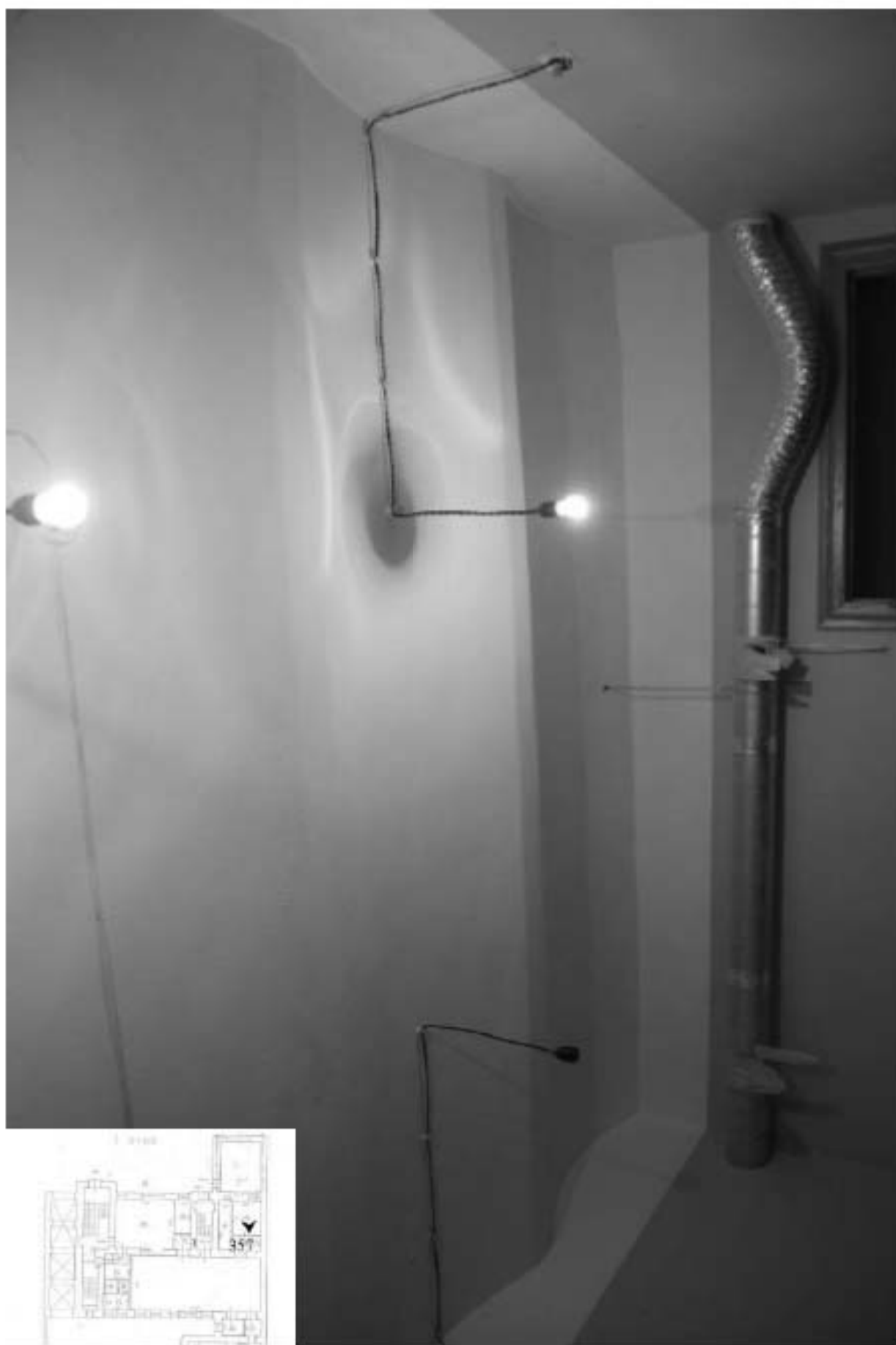
357. Этаж 1, помещение 15-Н. Интерьер комнаты 17,0 кв.м.
