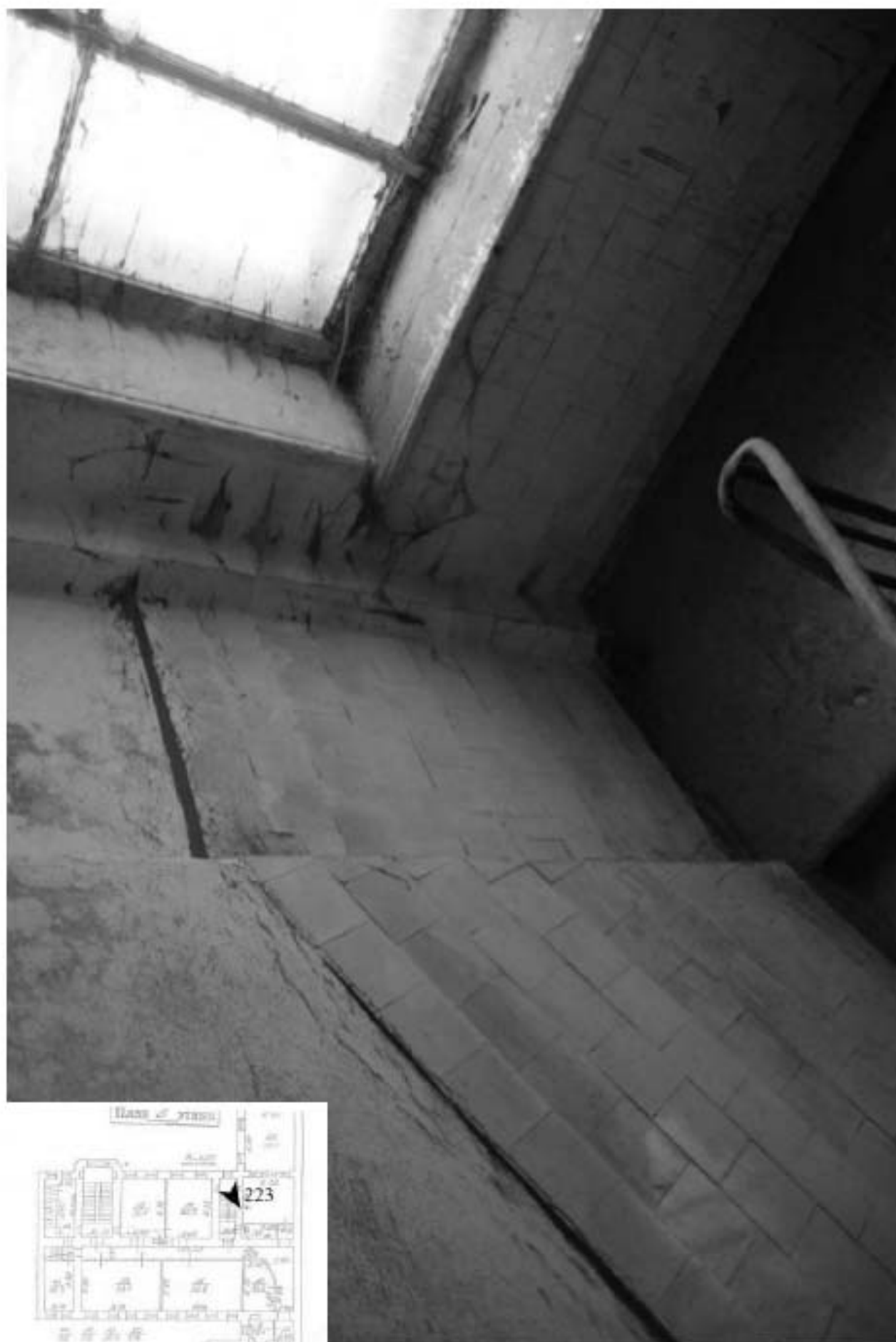
223. Лестница 4ЛК. Отделка стен.
