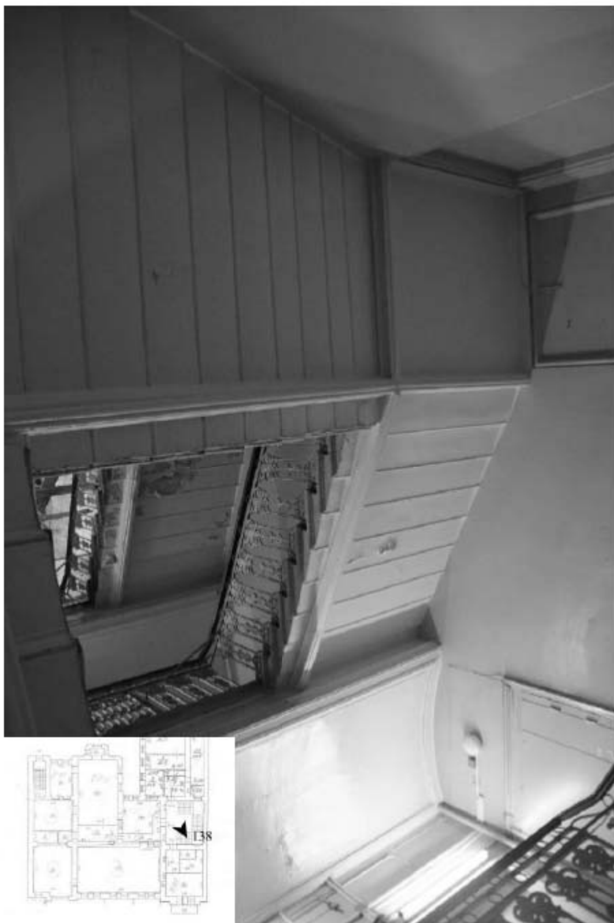
138. Вид парадной лестницы.
