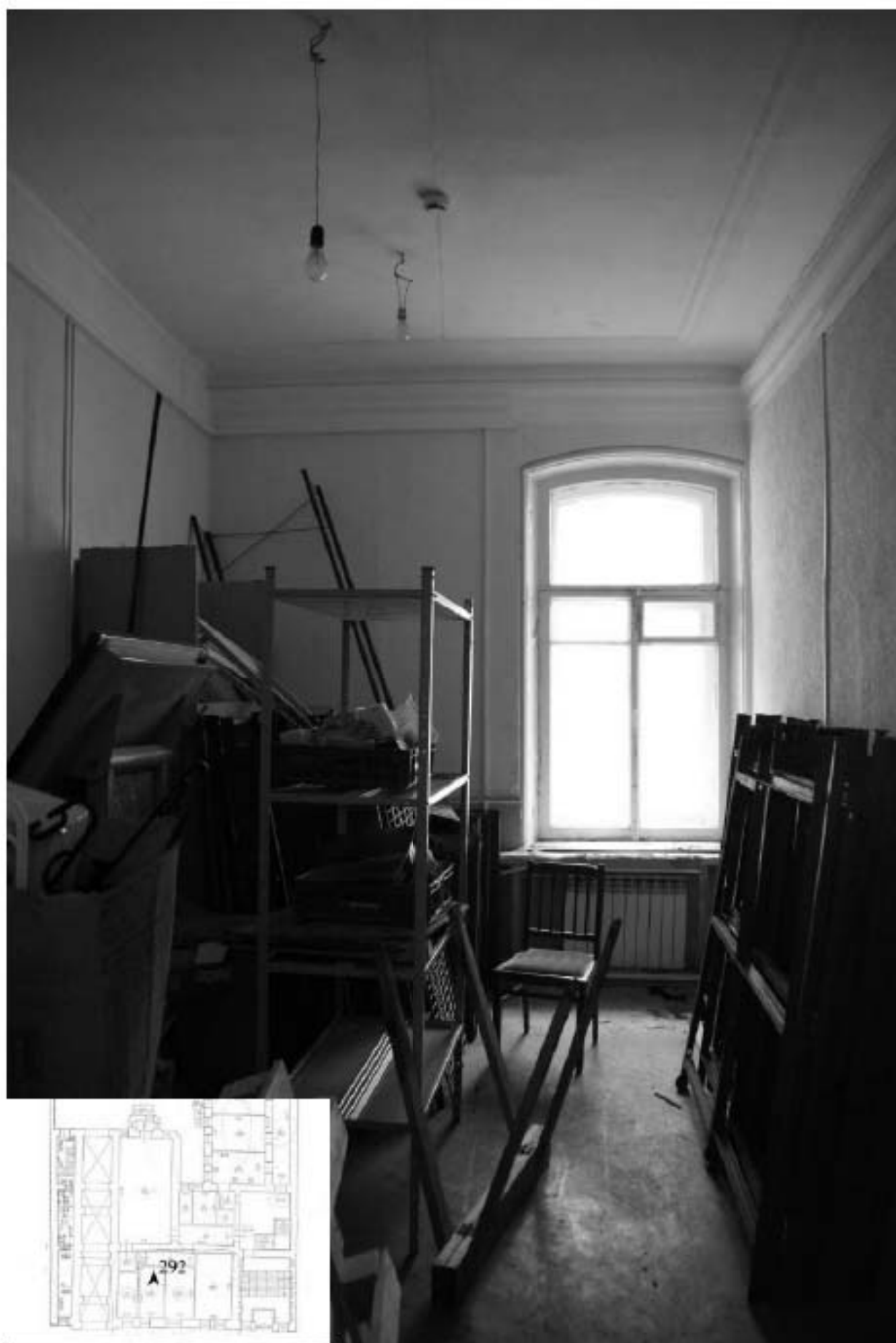
292. Этаж 1, помещение 20-Н. Интерьер комнаты 18,0 кв.м.
