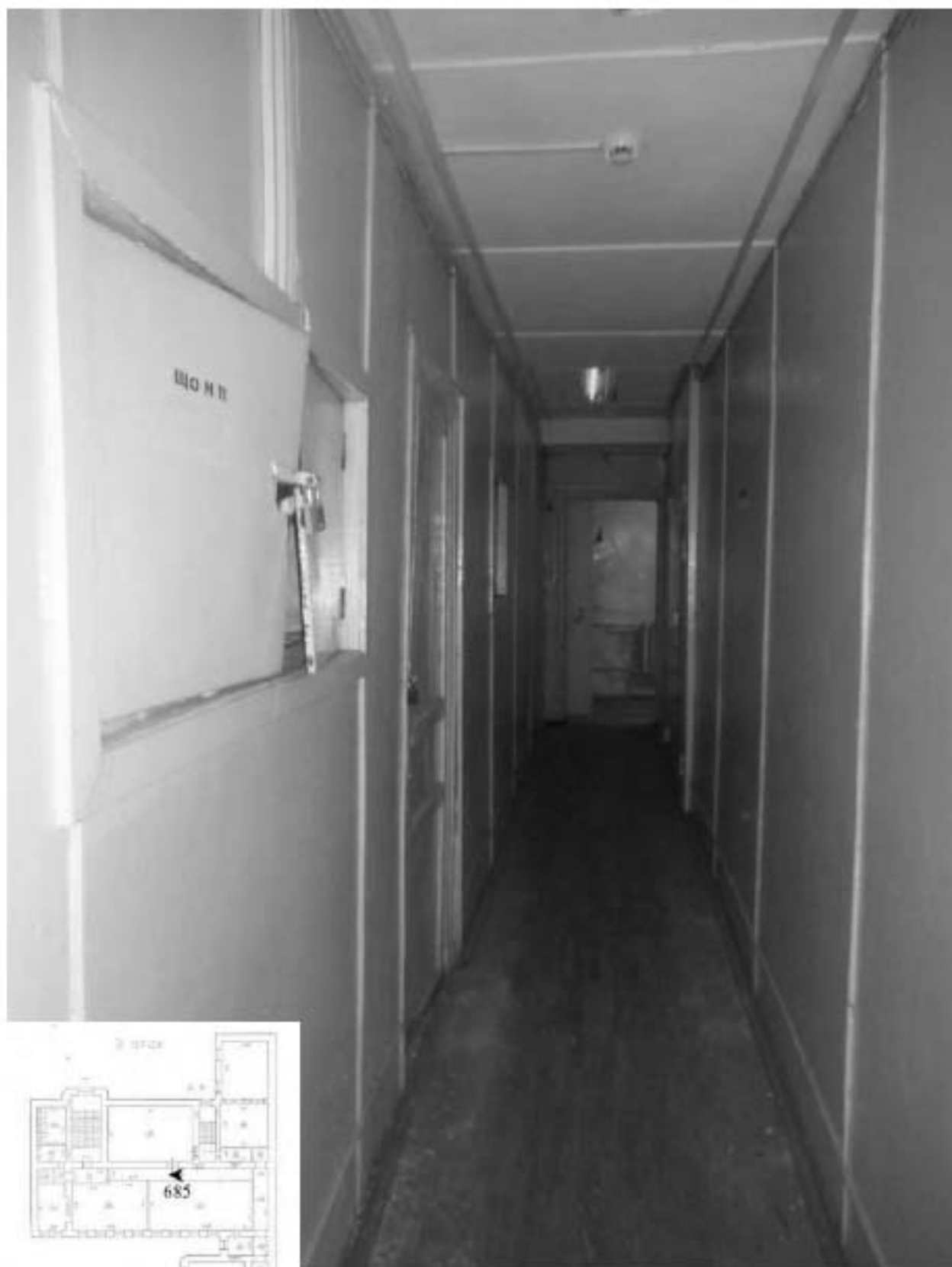
685. Этаж 3, помещение 17-Н. Вид коридора.
