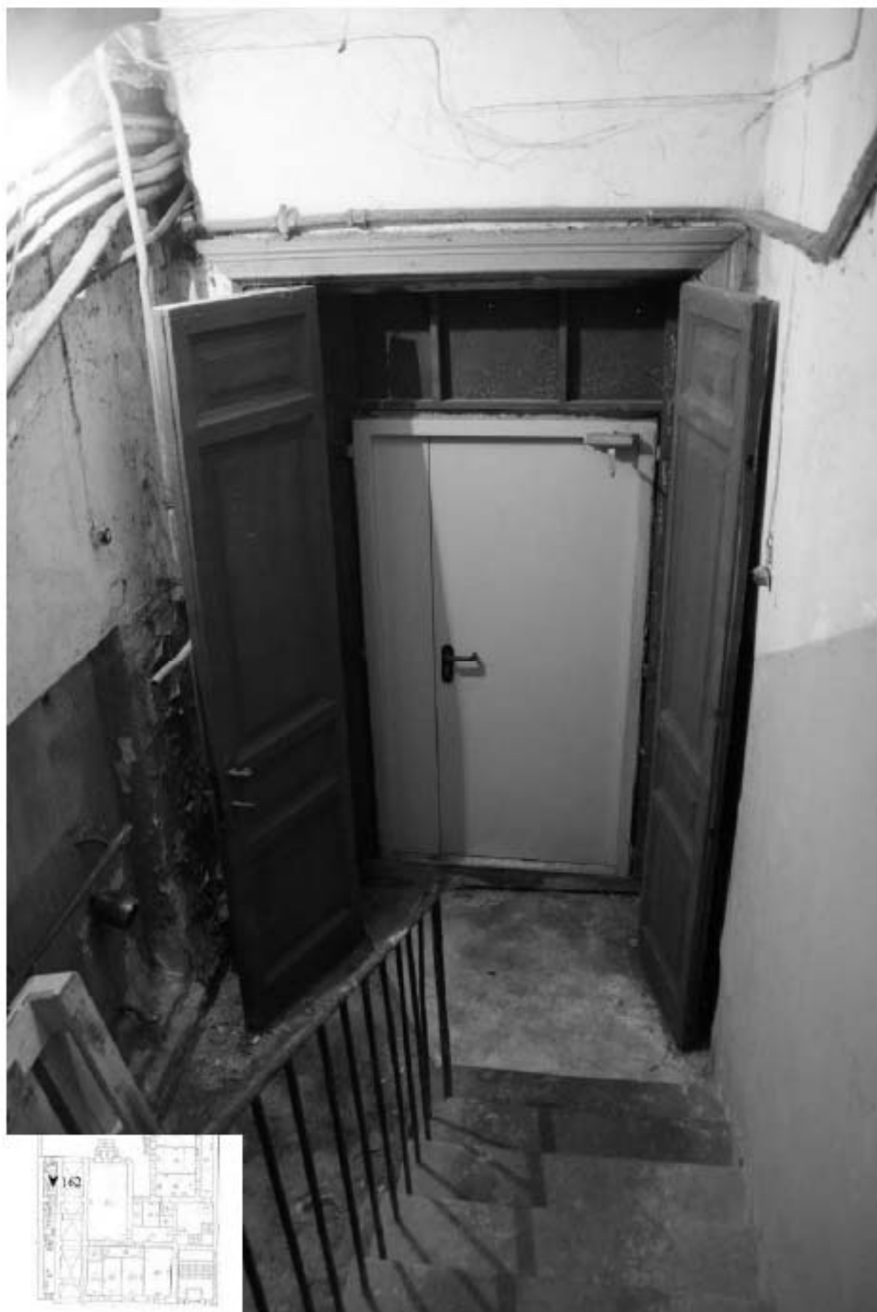
162. Лестница 2ЛК. Тамбур входной двери.
