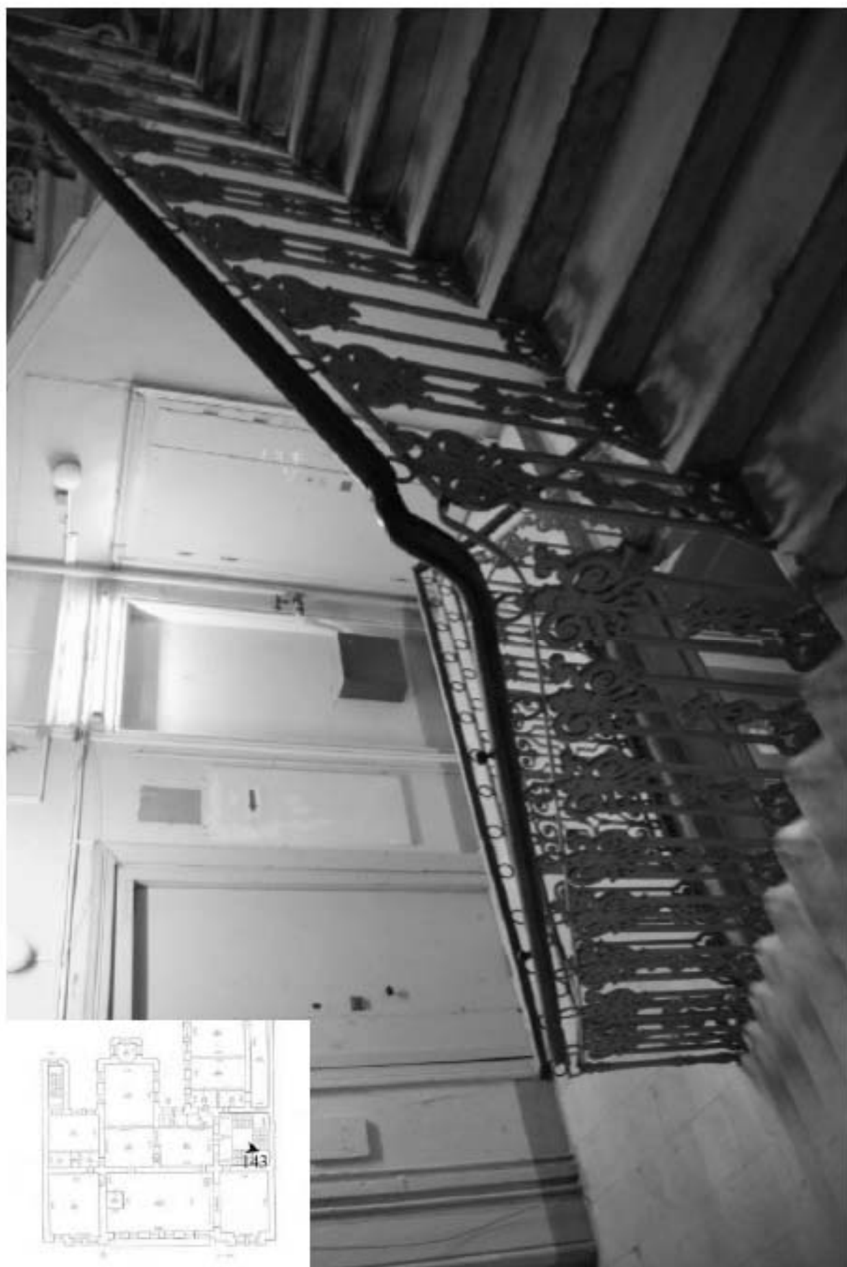
143. Вид на лестничную площадку 3 этажа.
