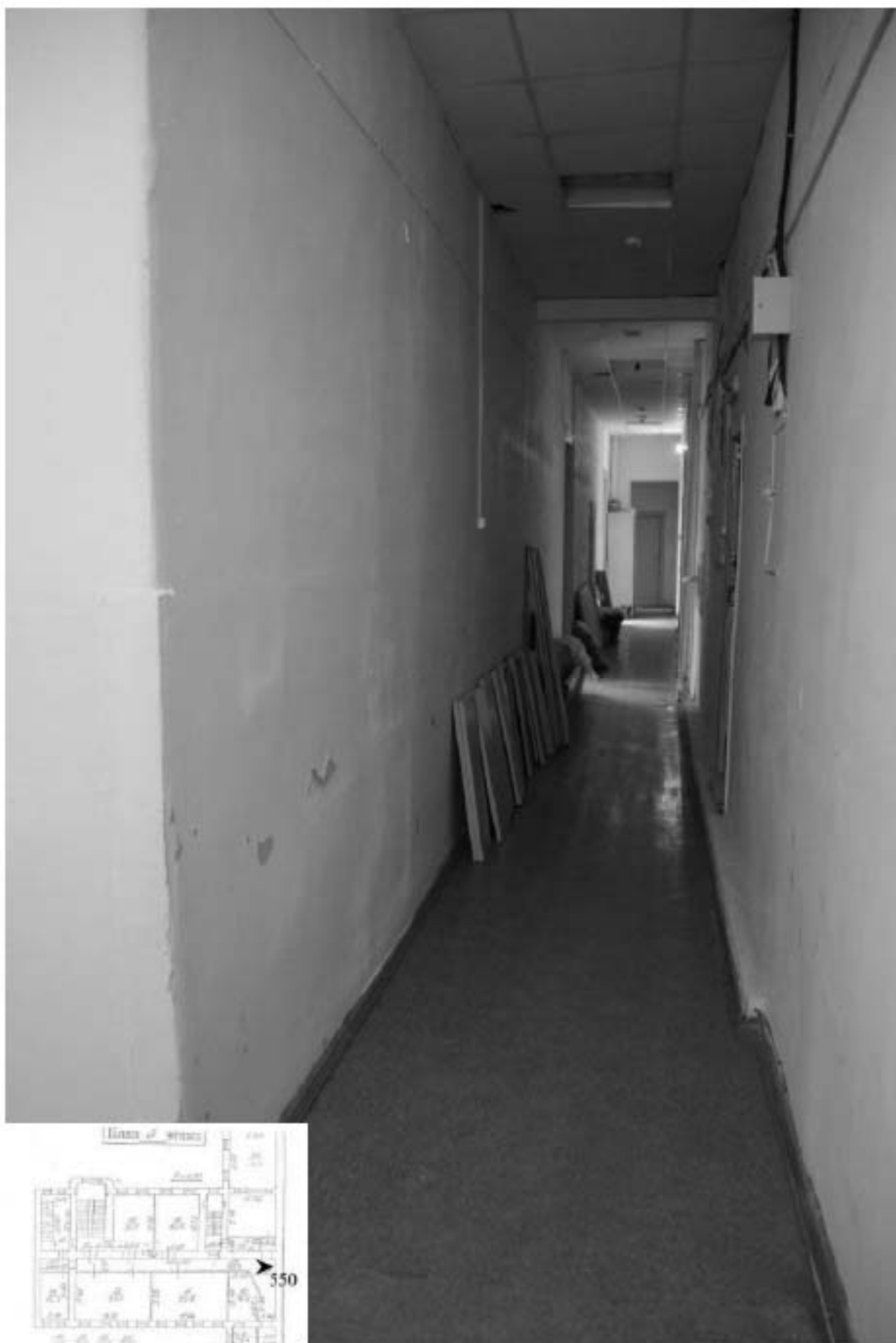
550. Этаж 2, помещение 16-Н. Вид коридора.
