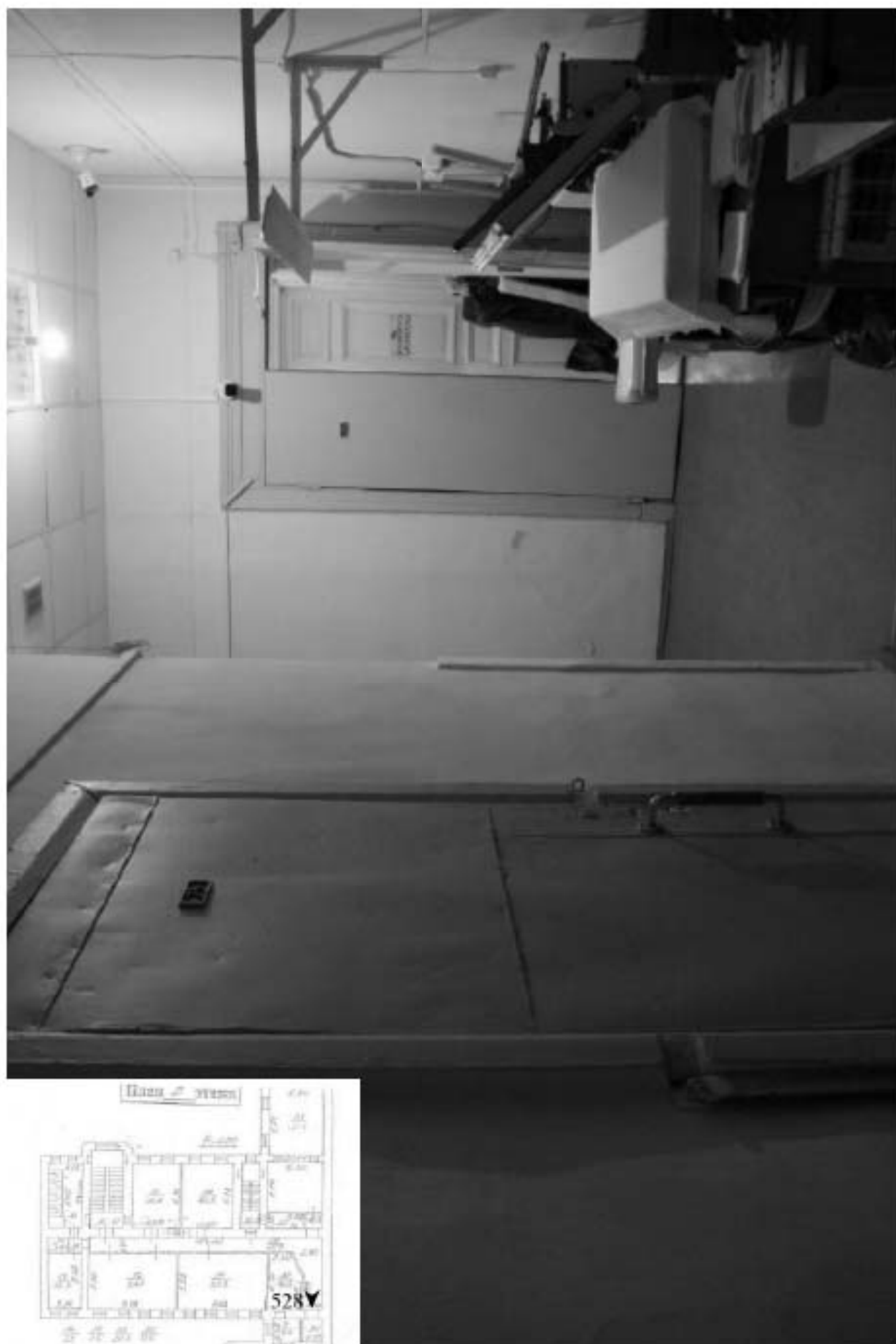
528. Этаж 2, помещение 16-Н. Вид коридора.
