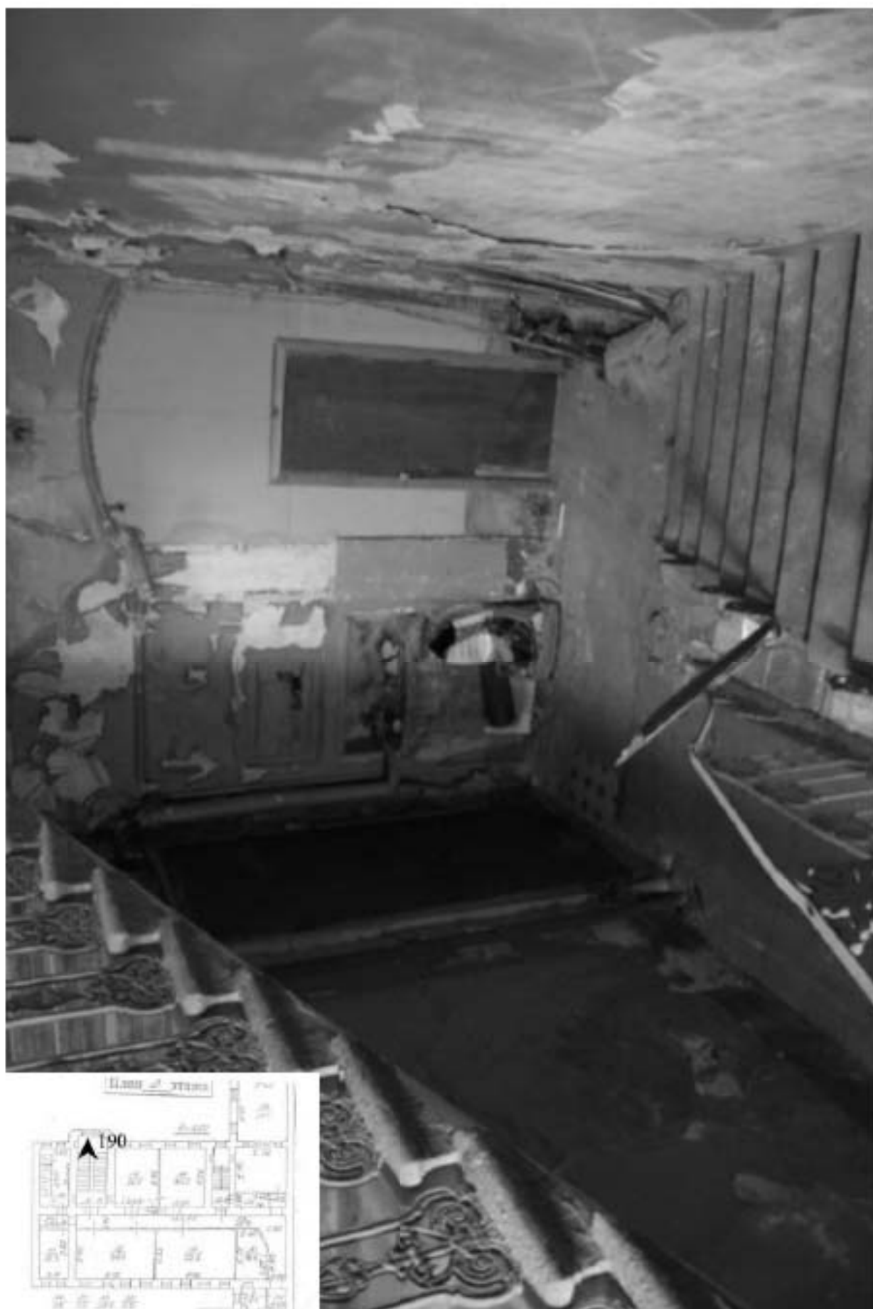
190. Лестница ЗЛК. Вид лестничную площадку 1 этажа.
