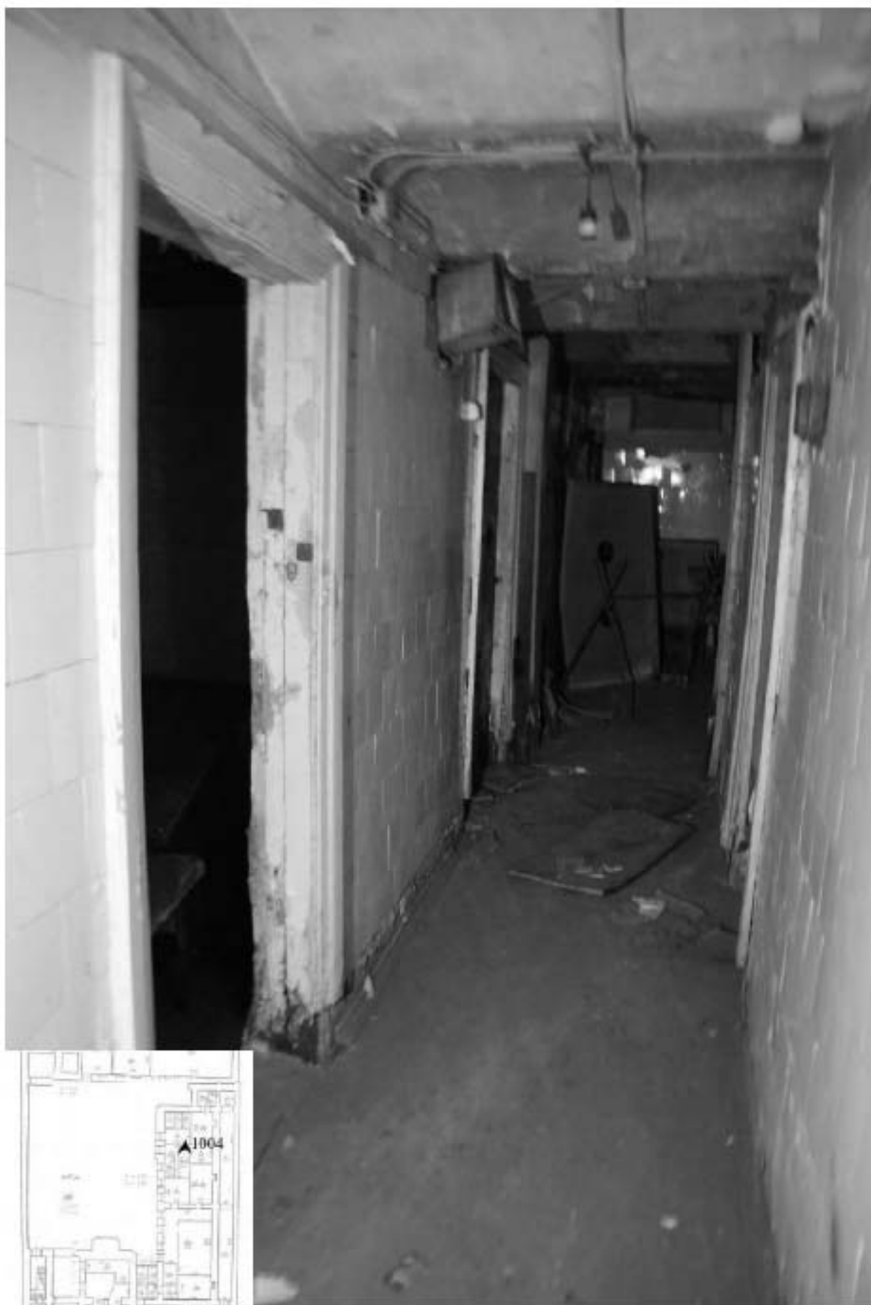
1004. Подвал, помещение 6-Н. Вид коридора.
