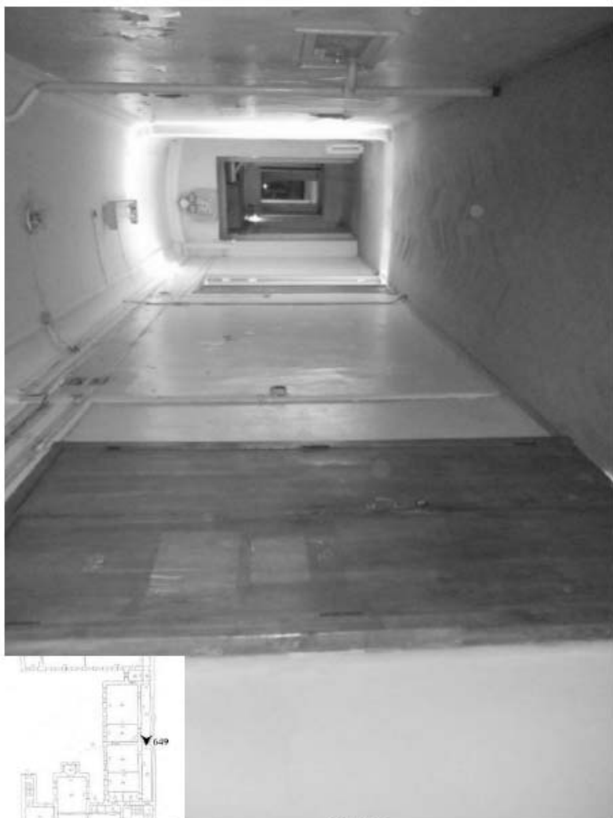
649. Этаж 3, помещение 17-Н. Вид коридора.
