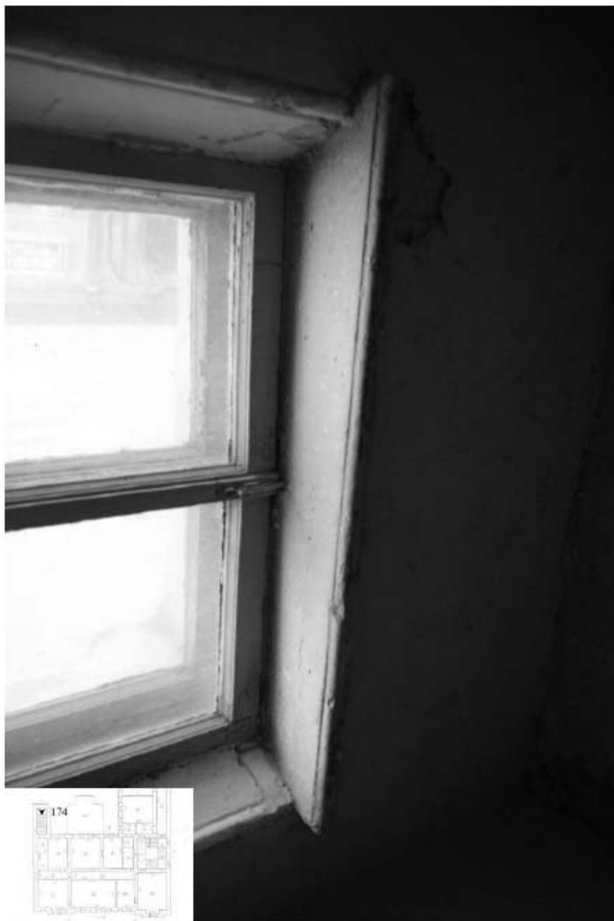
174. Лестница 2ЛК. Вид деревянного профилированного подоконника.
