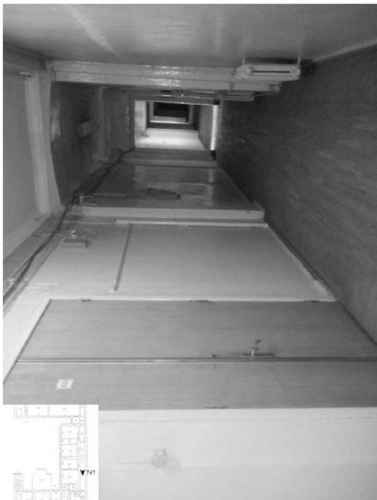
747. Этаж 4, помещение 40-Н. Вид коридора.
