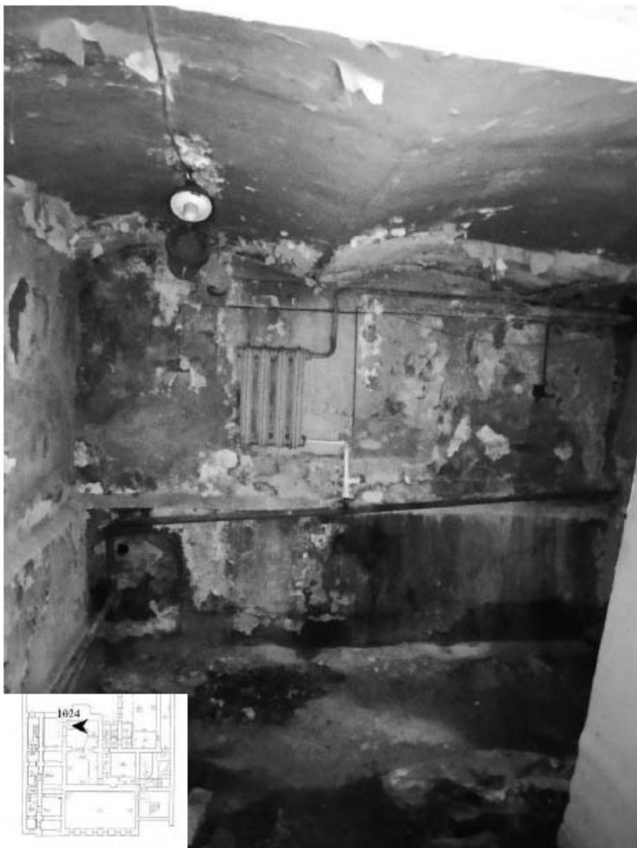
1024. Подвал, помещение 6-Н. Интерьер комнаты 14,9 кв.м.
