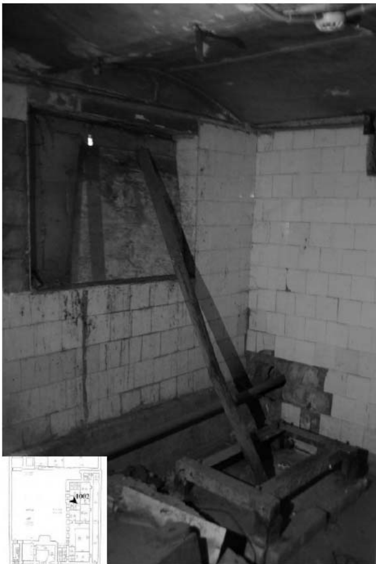
1002. Подвал, помещение 6-Н. Интерьер комнаты 9,4 кв.м.
