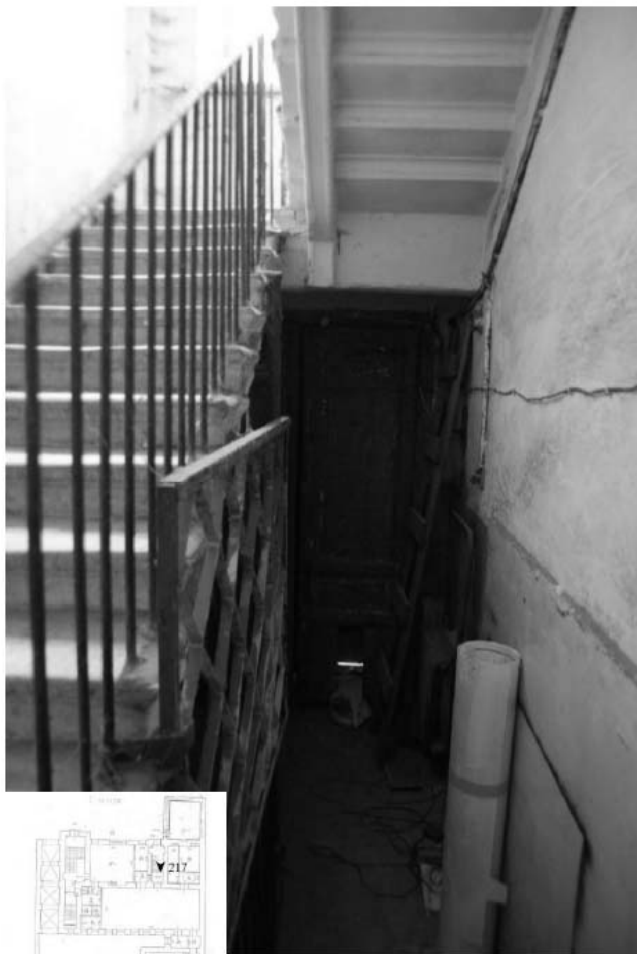
217. Лестница 4ЛК. Вид на входную дверь.
