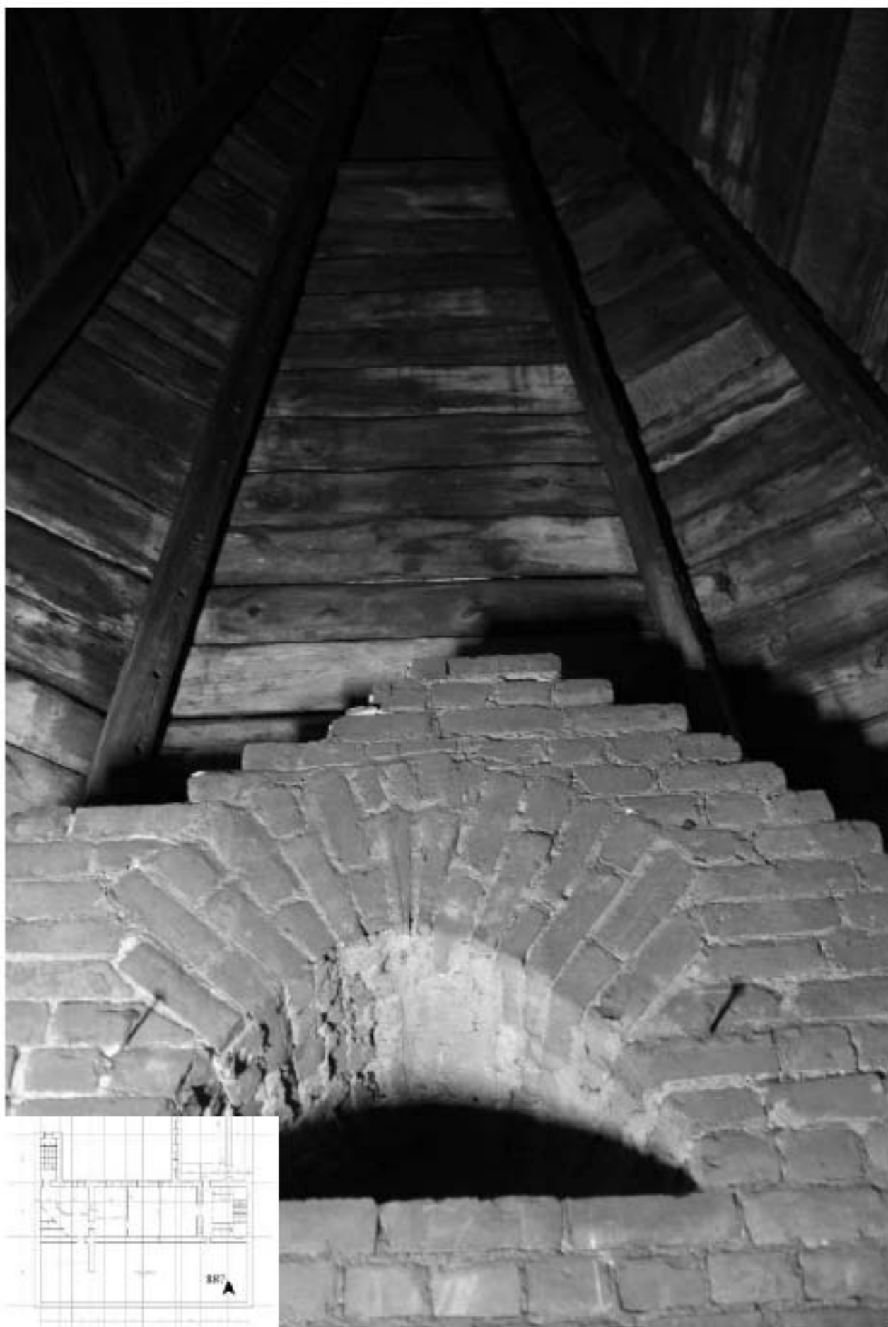
887. Этаж 5, интерьер чердака.
