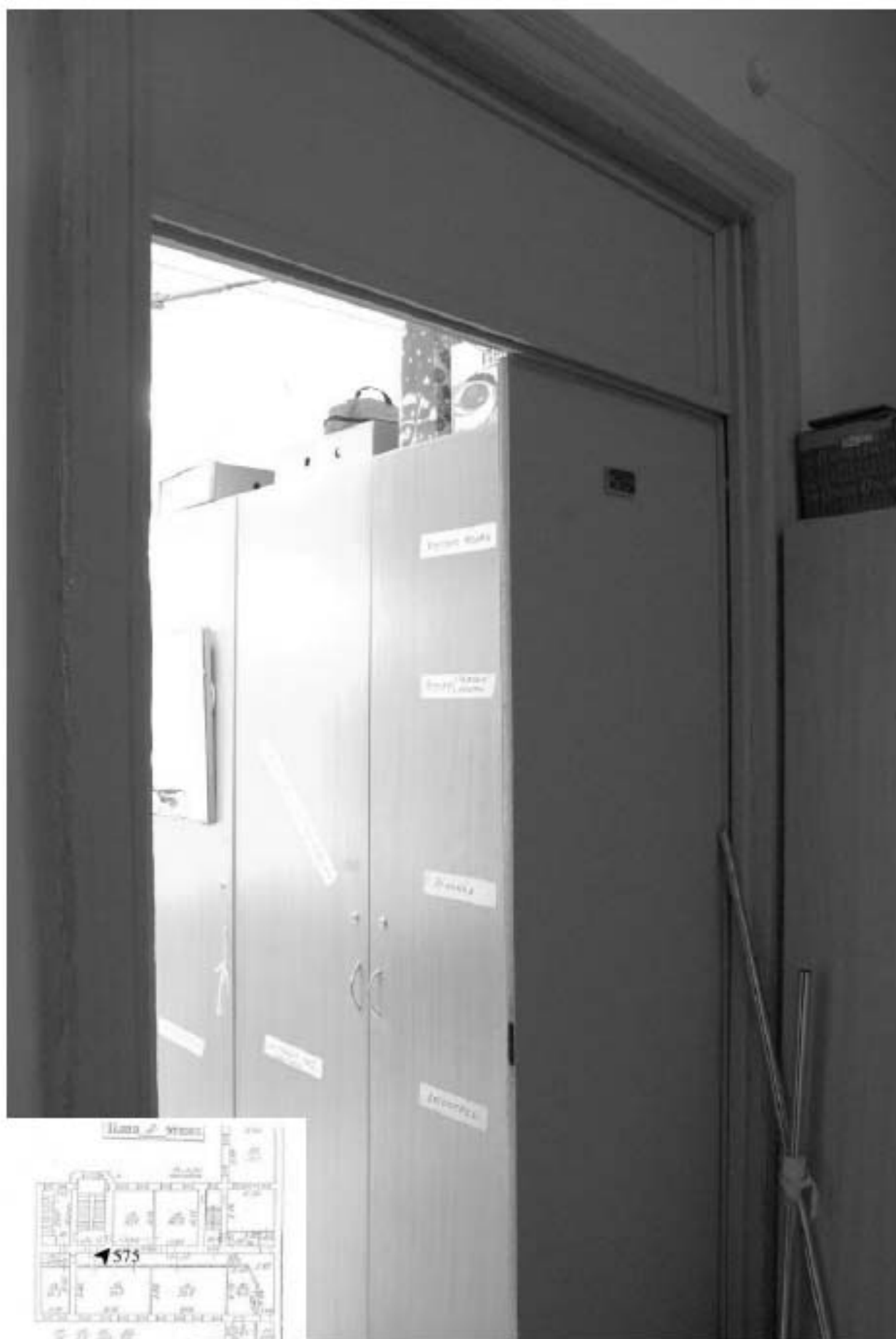
575. Этаж 2, помещение 16-Н. Дверь комнаты 51,1 кв.м.
