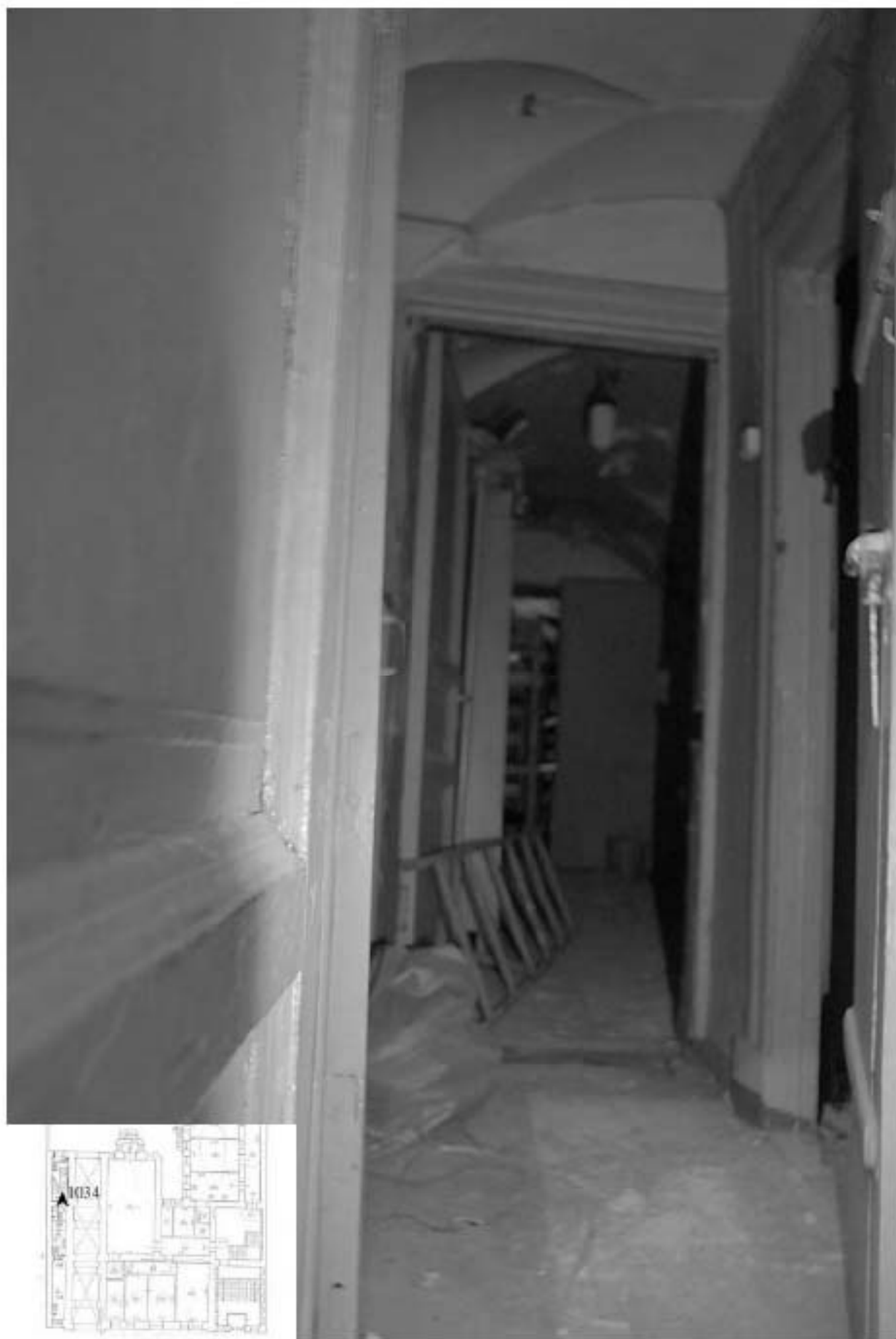
1034. Подвал, вход в помещение 14-Н с лестницы 2ЛК.
