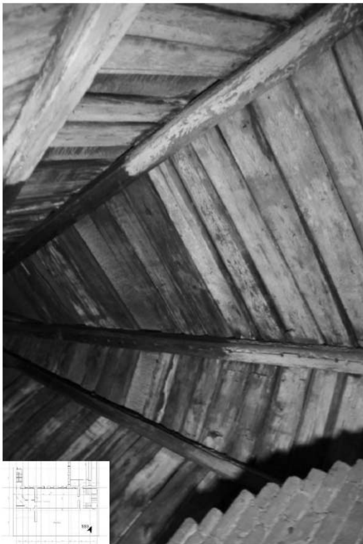
888. Этаж 5, интерьер чердака.
