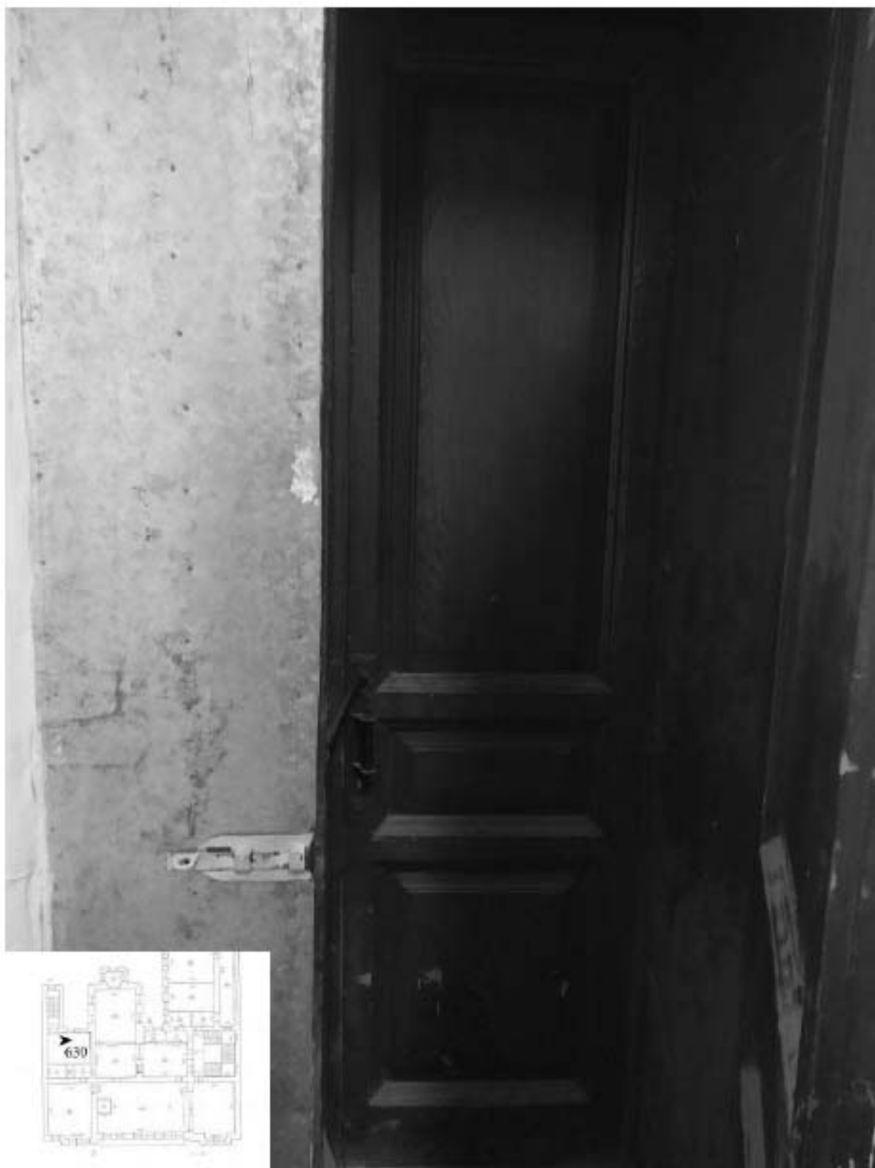
630. Этаж 3, помещение 37-Н. Дверь тамбура лестницы 2 ЛК.
