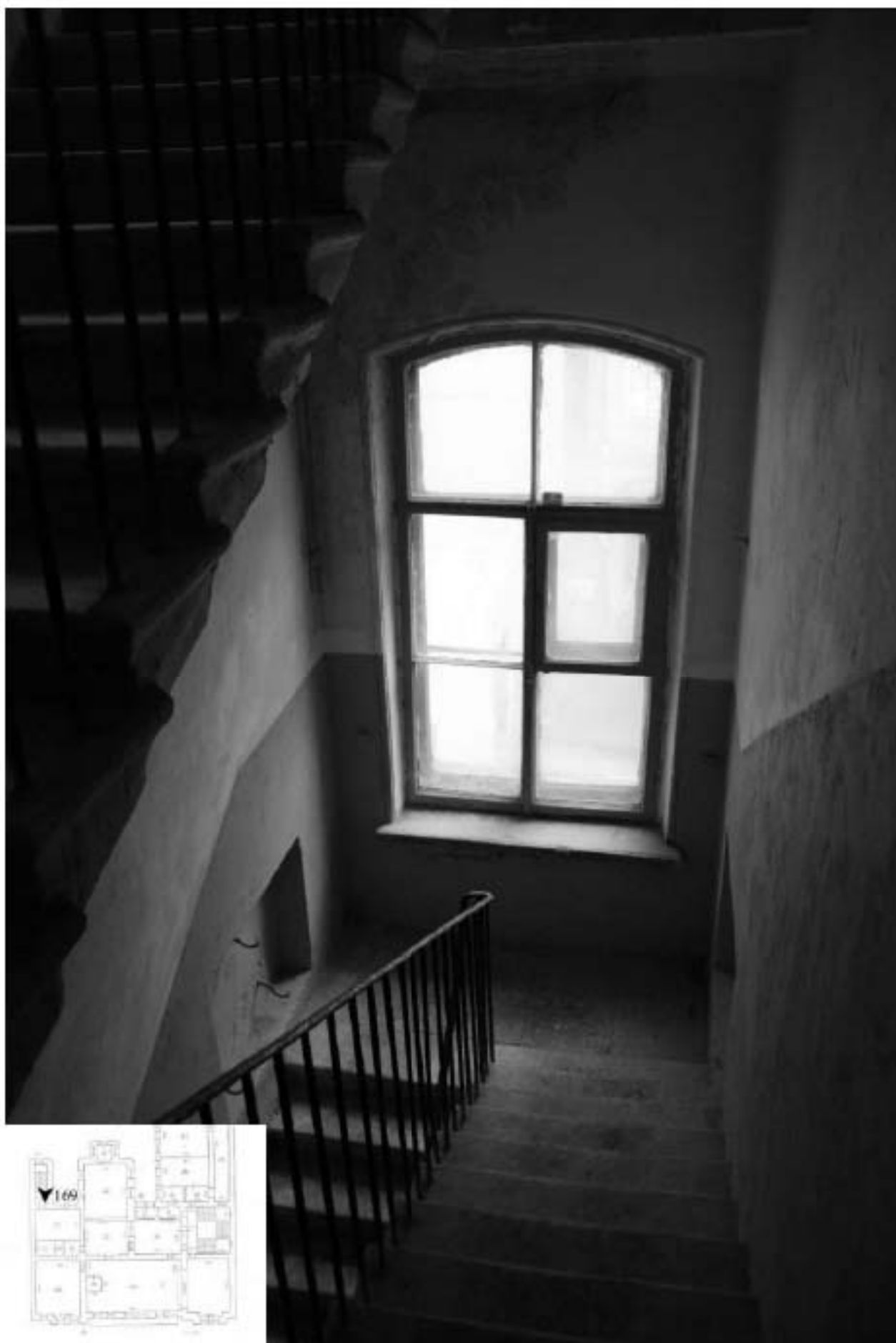
169. Лестница 2ЛК. Лестничная площадка между 2 и 3 этажами.
