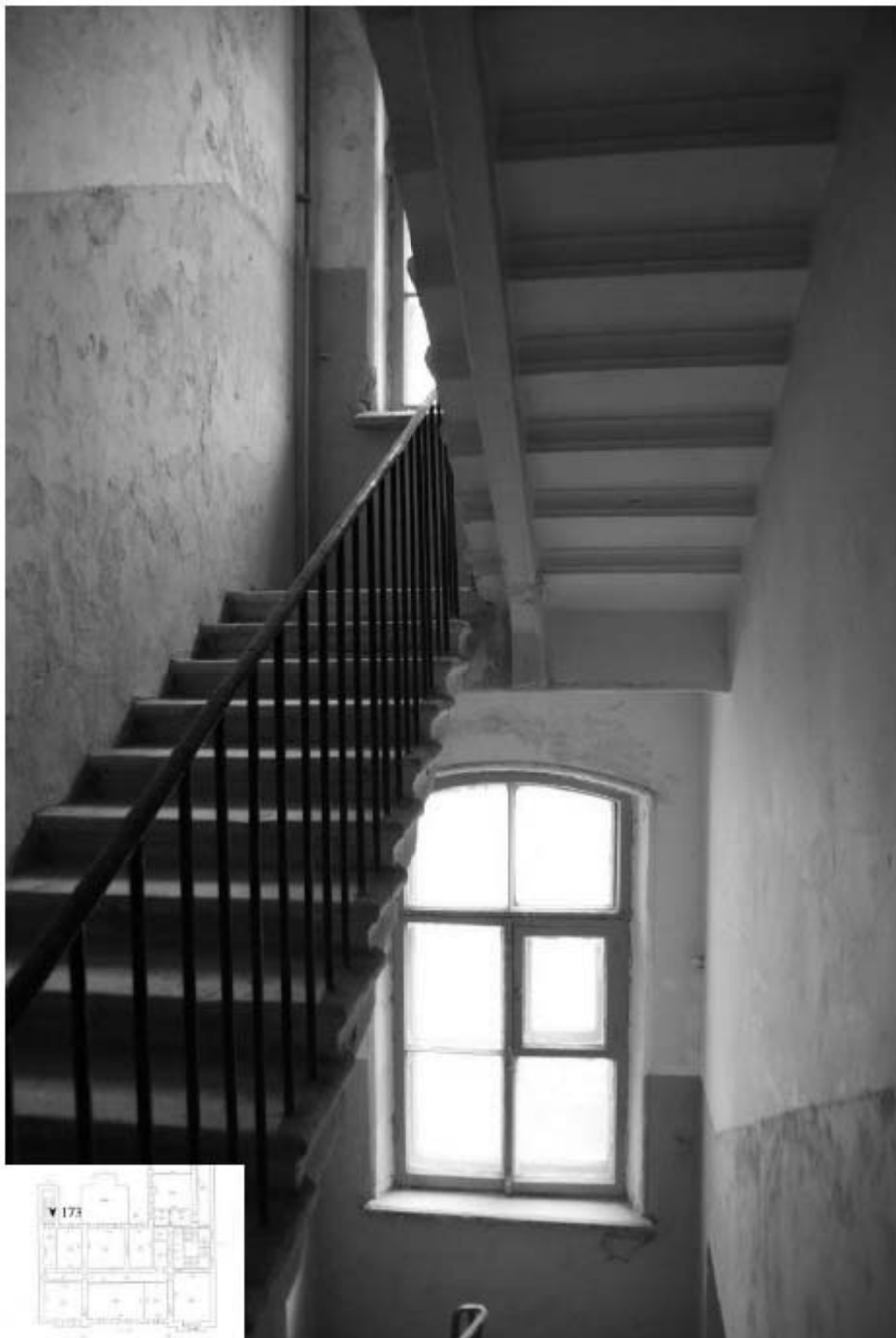
173. Лестница 2ЛК. Вид лестничного пролёта.
