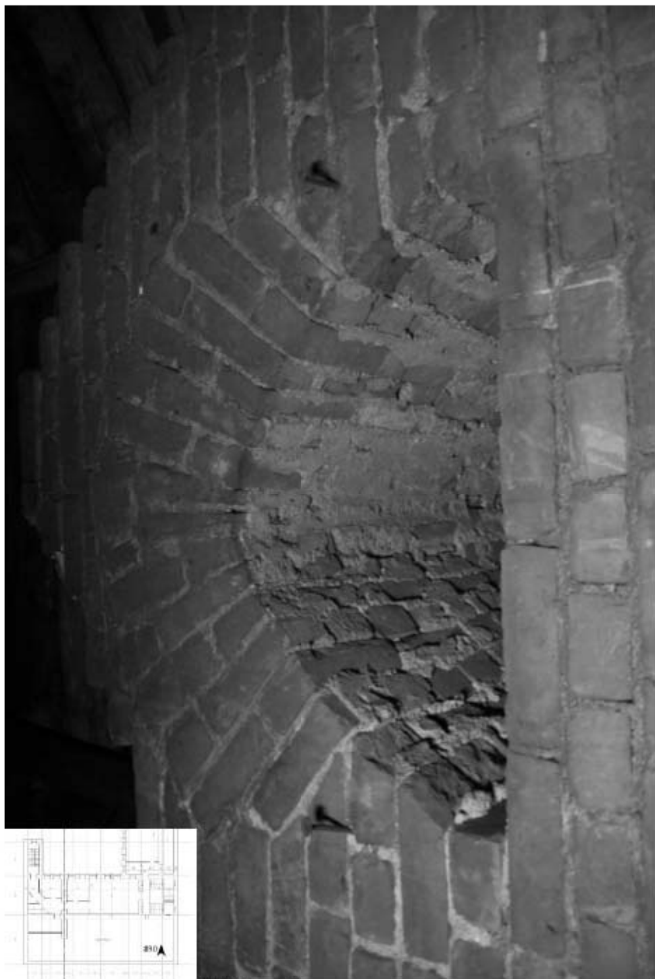
890. Этаж 5, интерьер чердака.
