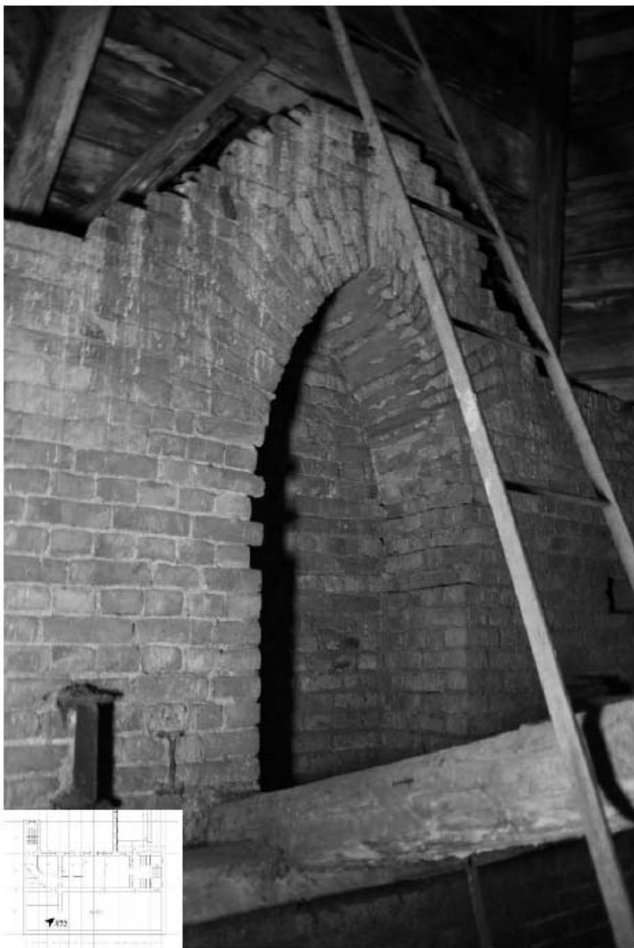
872. Этаж 5, интерьер чердака.
