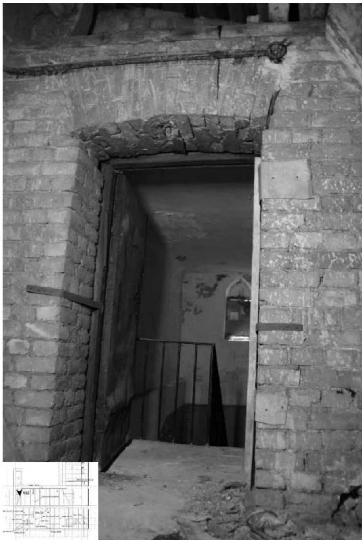
900. Чердак, выход на лестницу 2ЛК.
