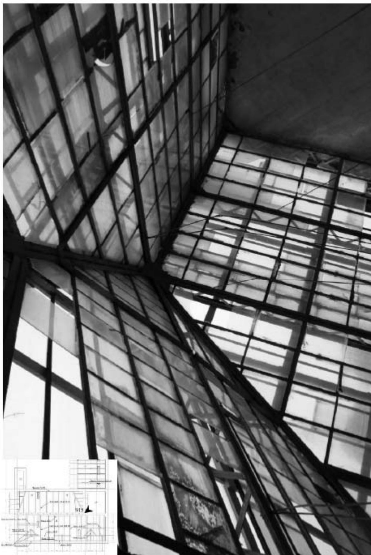
915. Чердак. Вид на конструкции светового фонаря.
