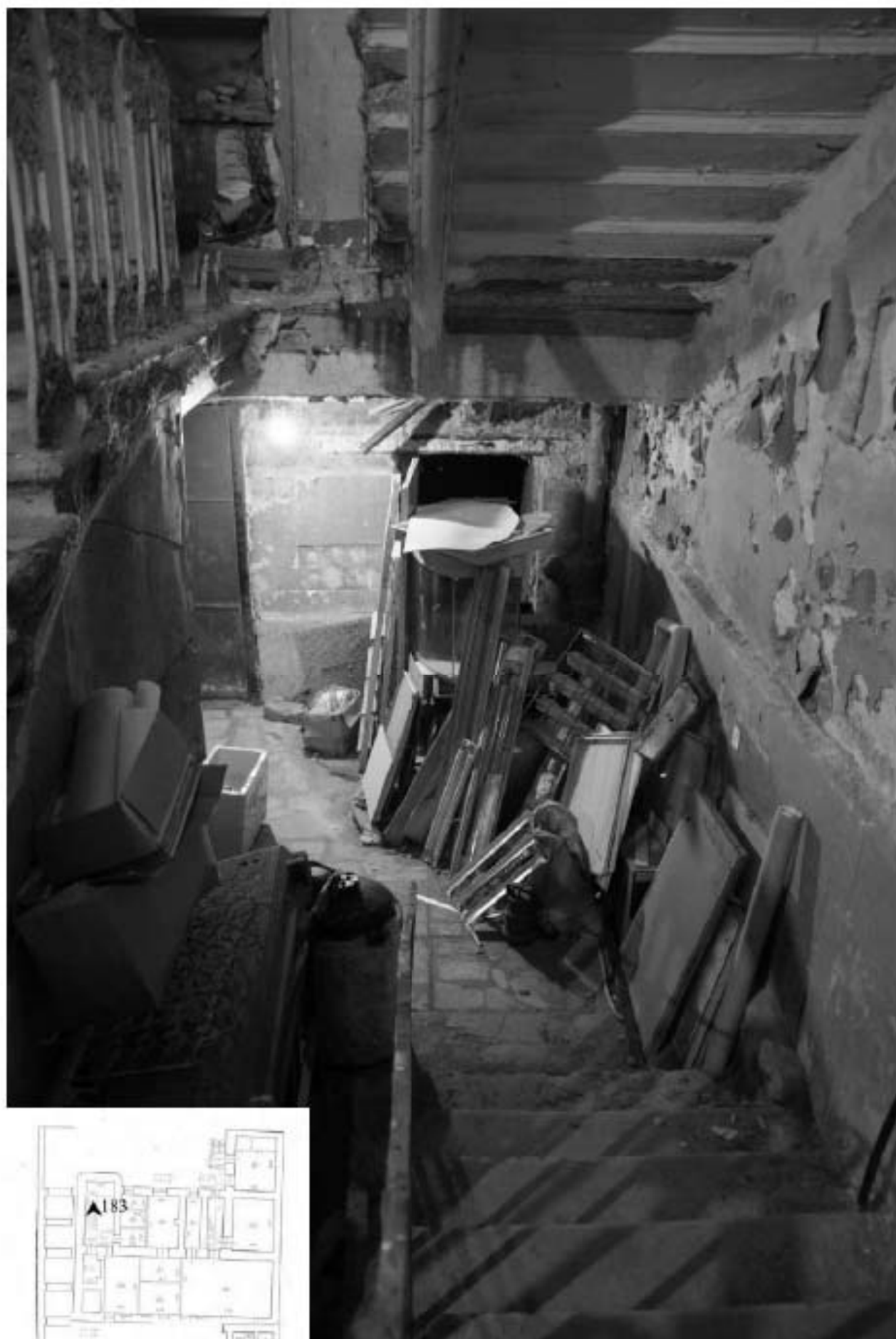
183. Лестница 3ЛК. Вход в подвал.
