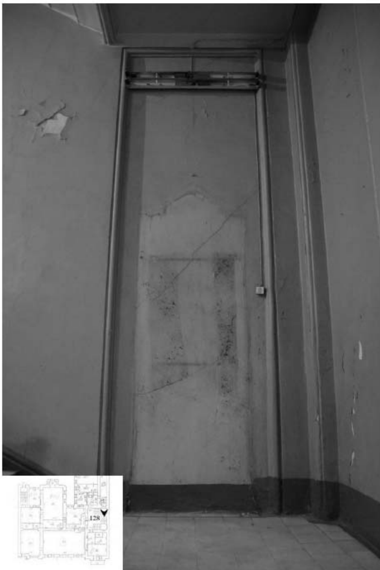
128. Ниша лестничной площадки парадной лестницы.
