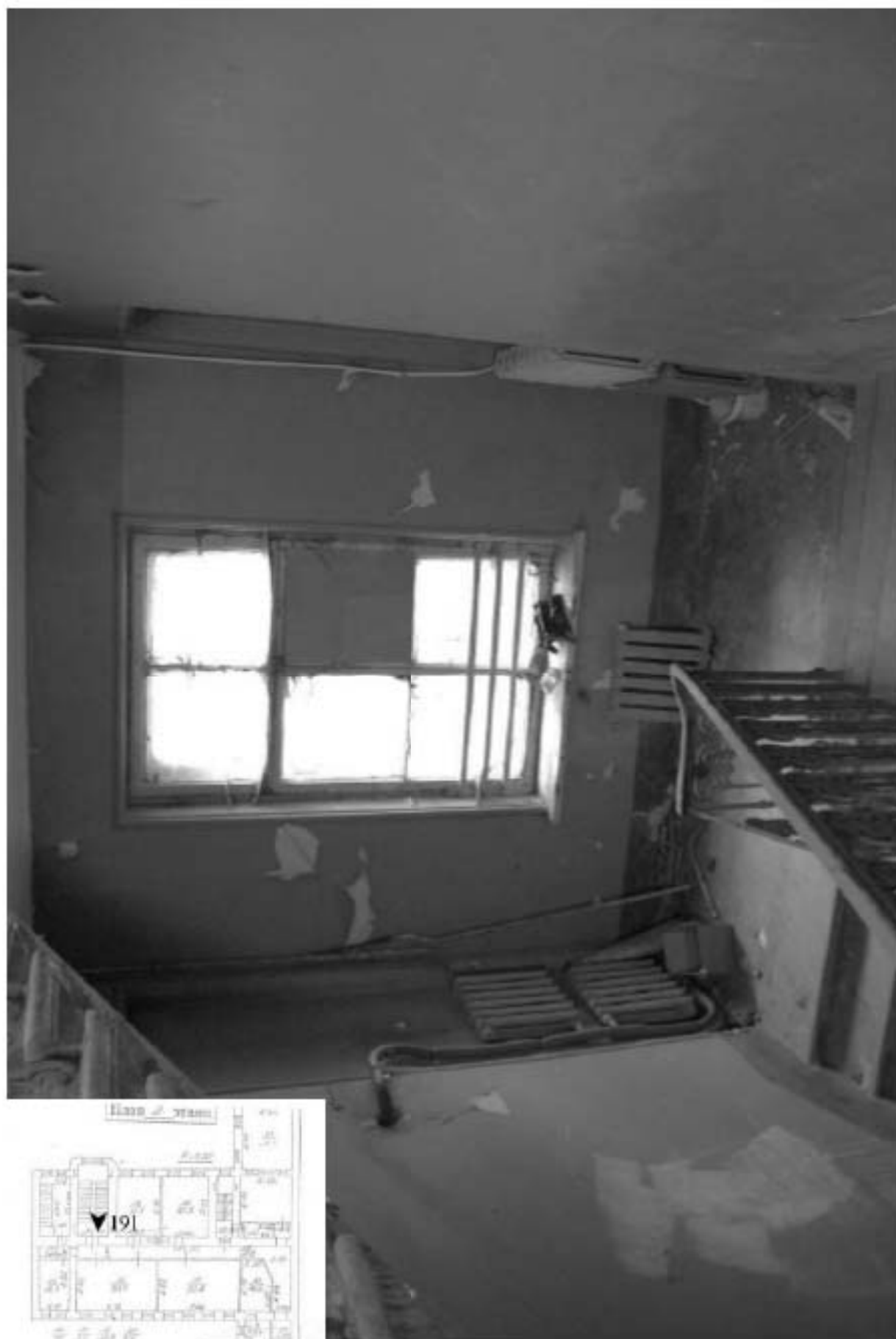
191. Лестница ЗЛК. Вид лестничной площадки между 1 и 2 этажом.
