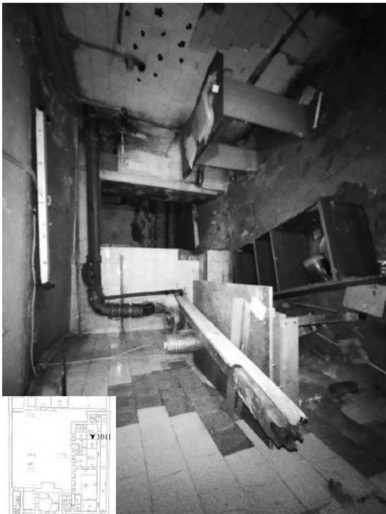
1011. Подвал, помещение 6-Н. Интерьер комнаты 9,9 кв.м.
