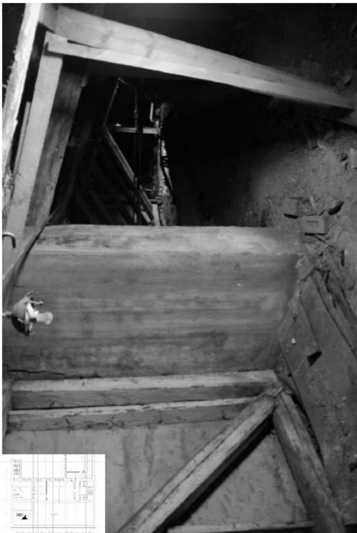
883. Этаж 5, интерьер чердака.
