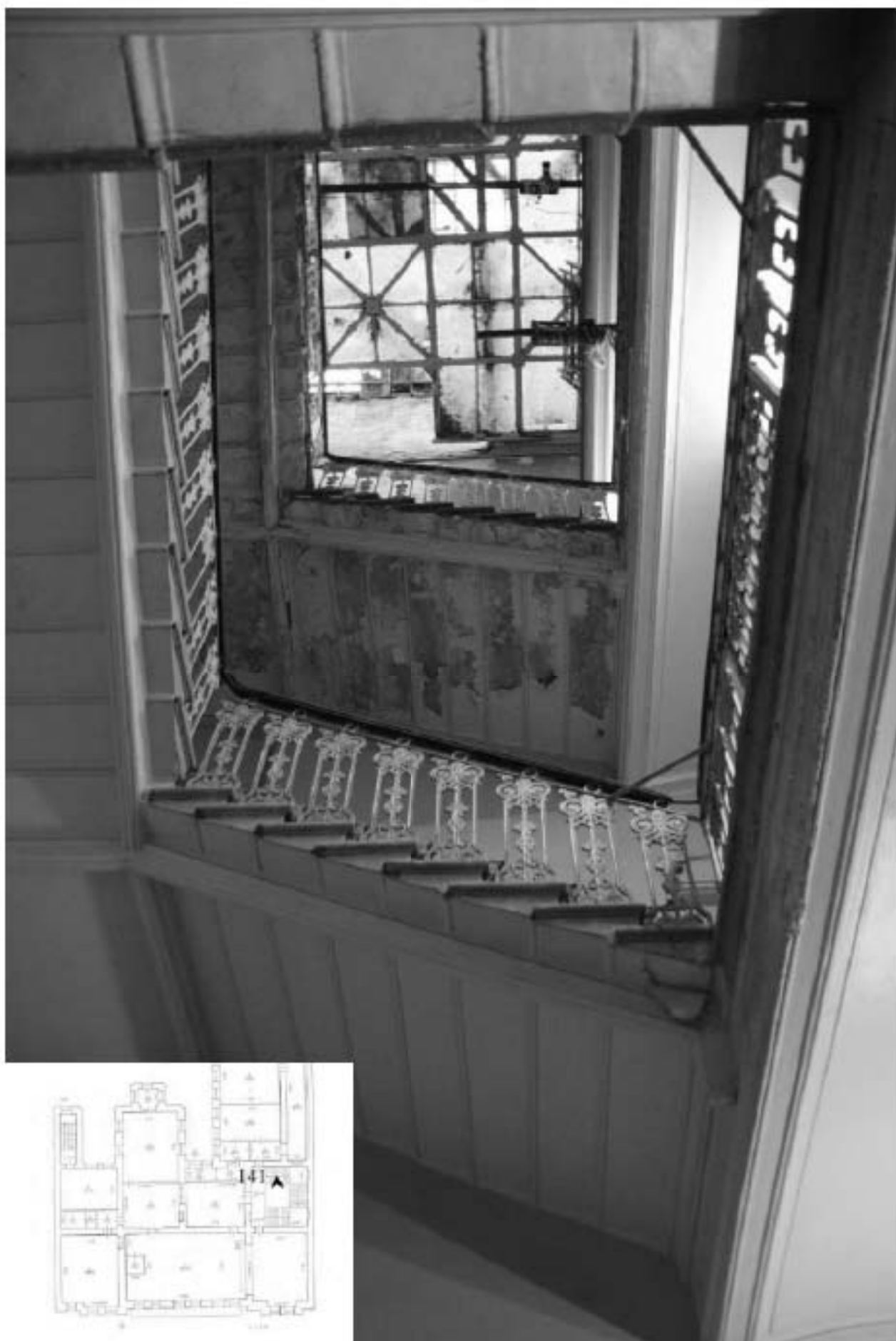
141. Вид на пространство лестницы и световой фонарь.
