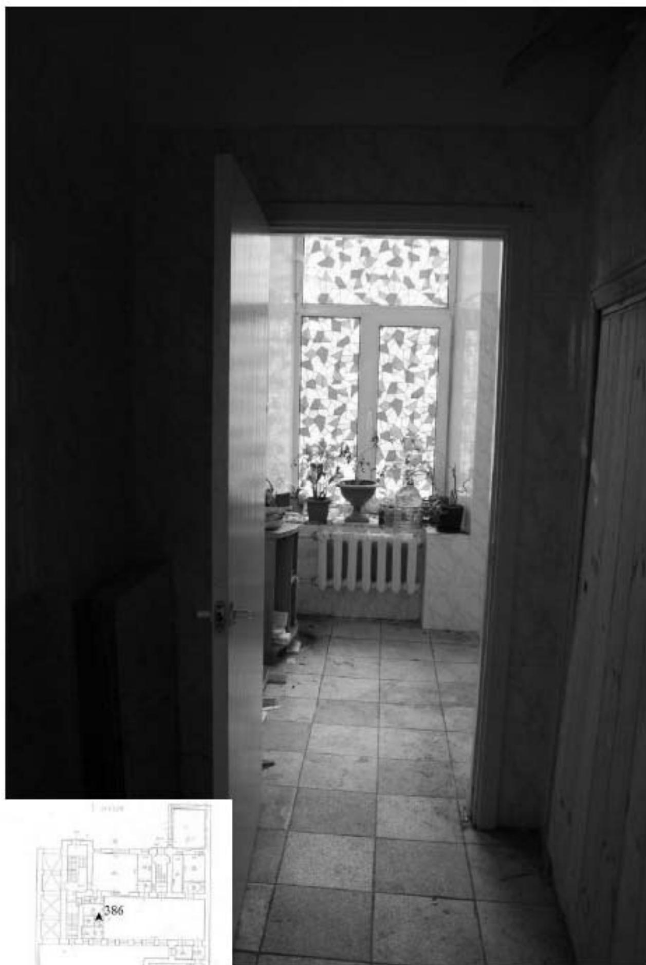
386. Этаж 1, помещение 15-Н. Интерьер душевой.
