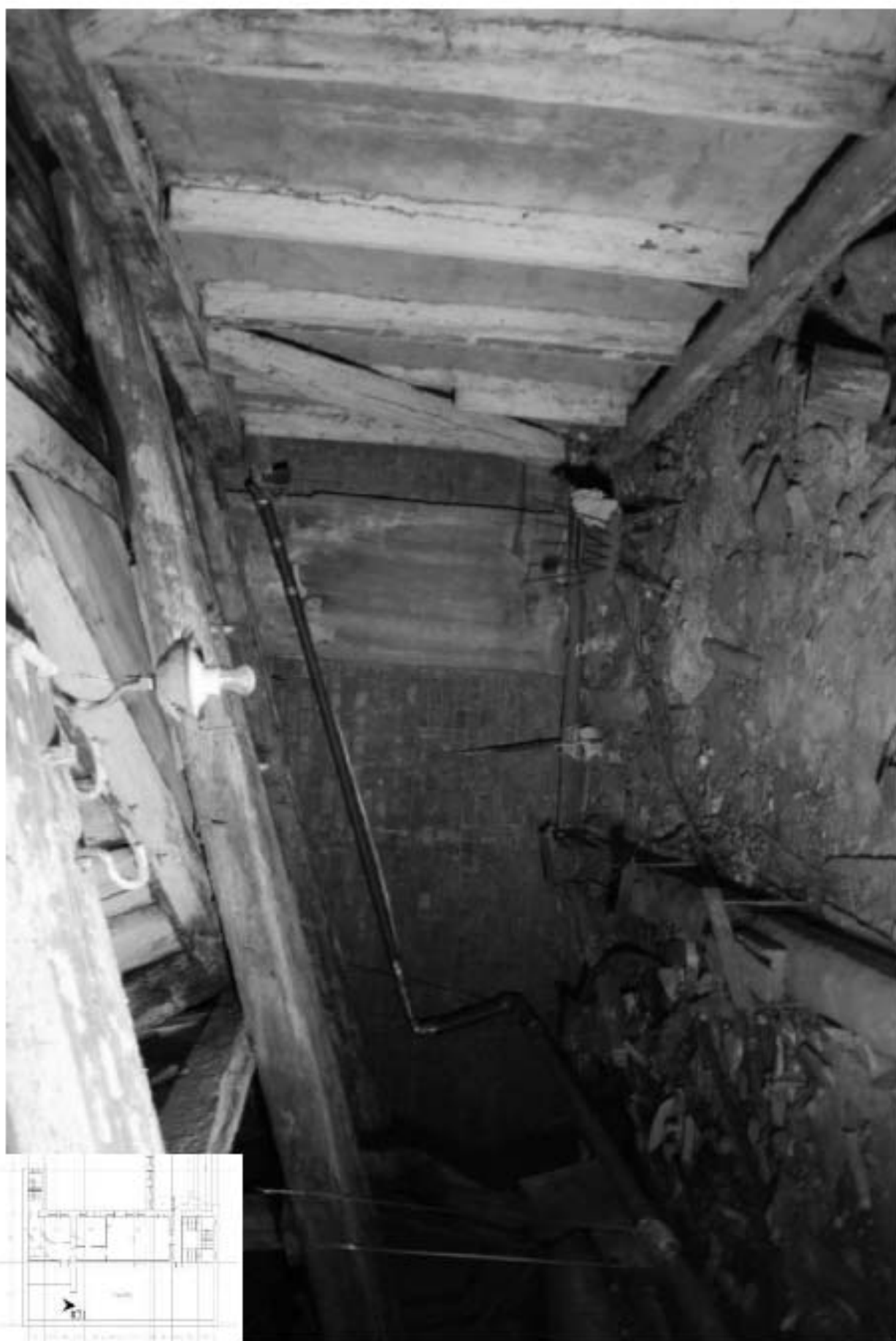
871. Этаж 5, интерьер чердака.
