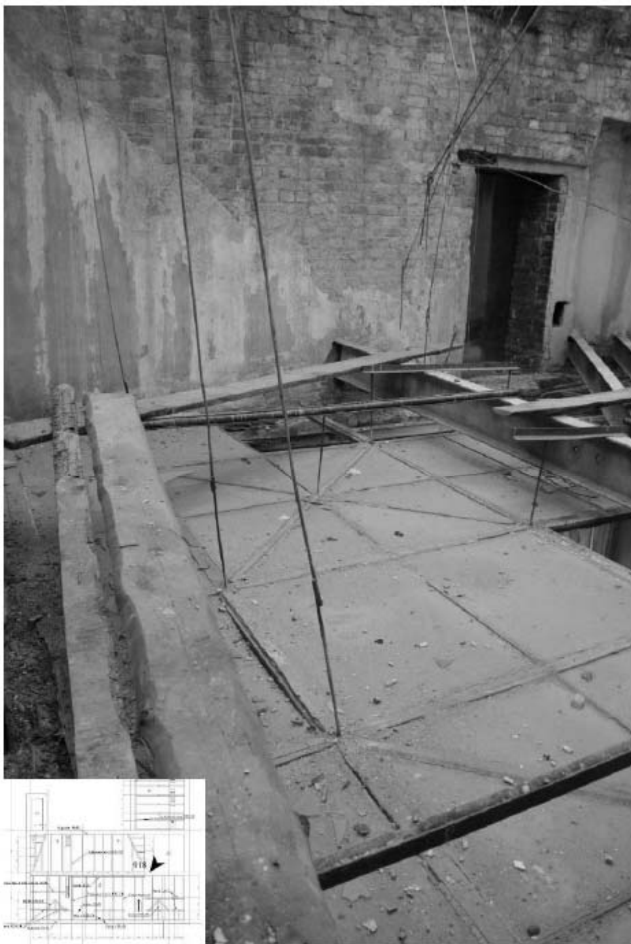
918. Чердак. Вид на конструкции светового фонаря.
