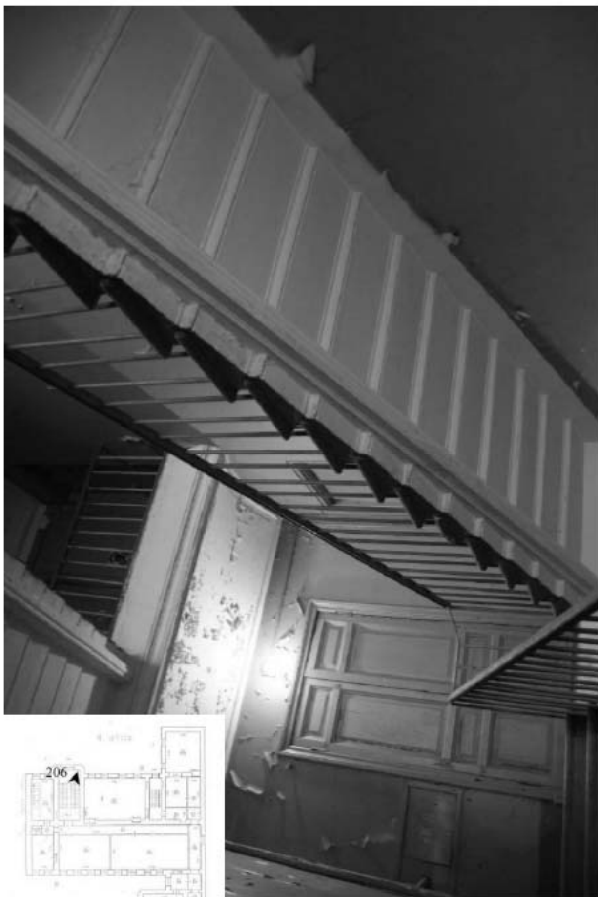
206. Лестница ЗЛК. Фрагмент.
