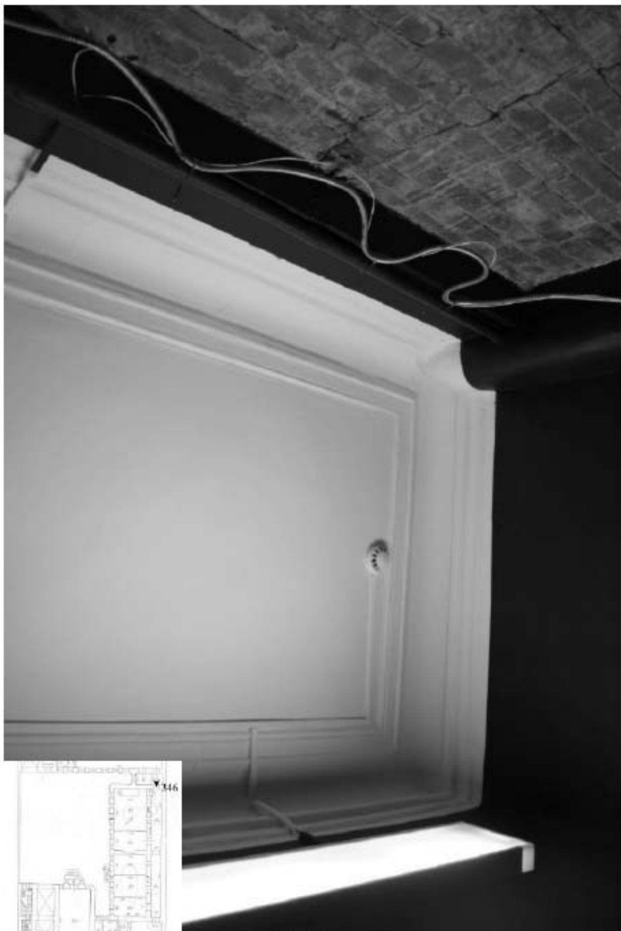
346. Этаж 1, помещение 15-Н. Интерьер комнаты 3,7 кв.м.
