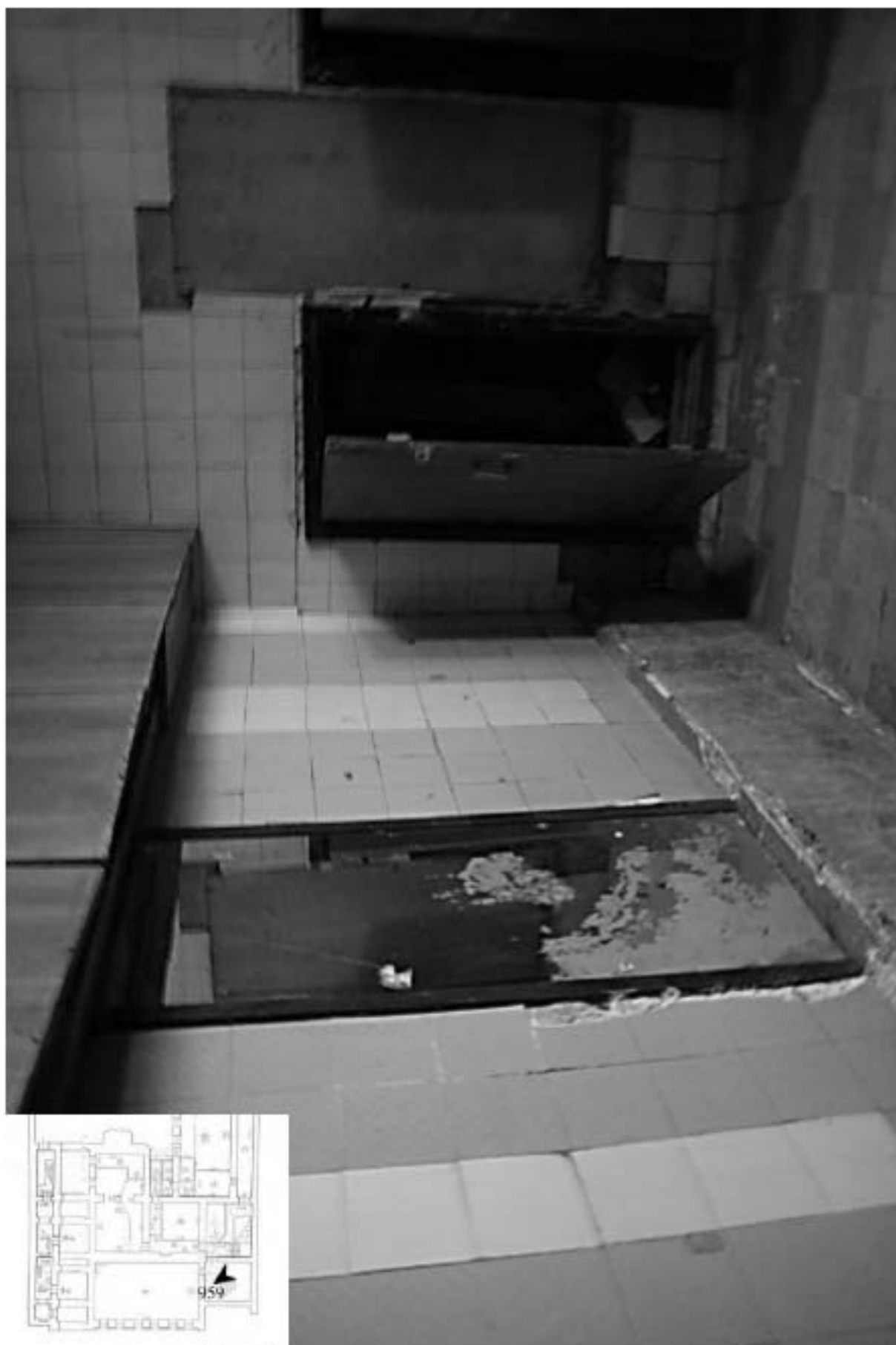
959. Лестничная площадка входа в подвал.
