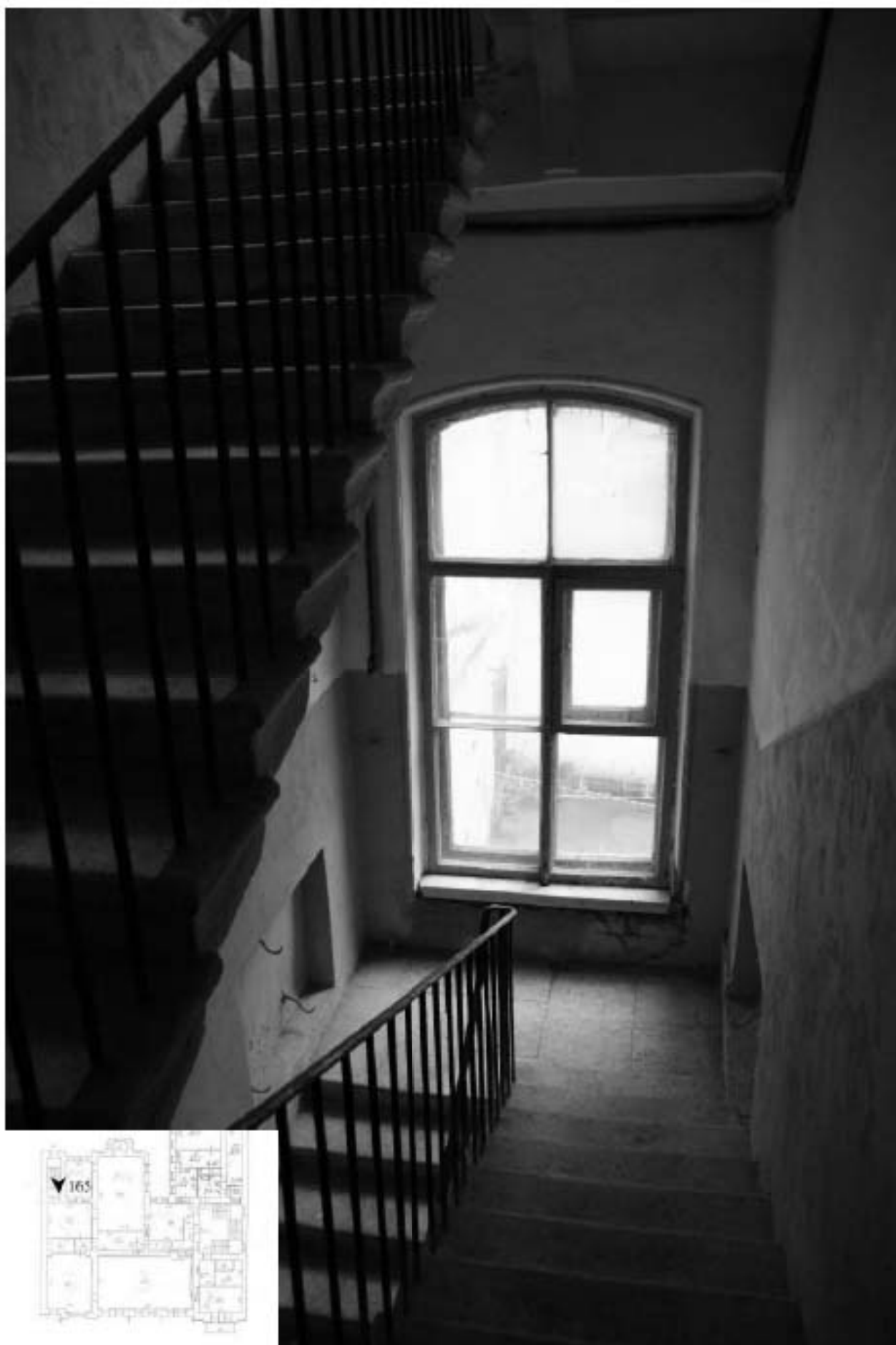
165. Лестница 2ЛК. Лестничная площадка между 1 и 2 этажами.
