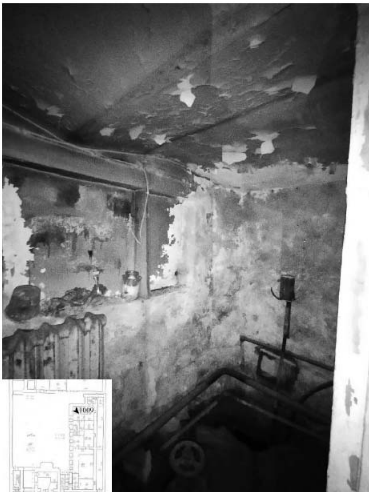
1009. Подвал, помещение 6-Н. Интерьер комнаты 2,5 кв.м.
