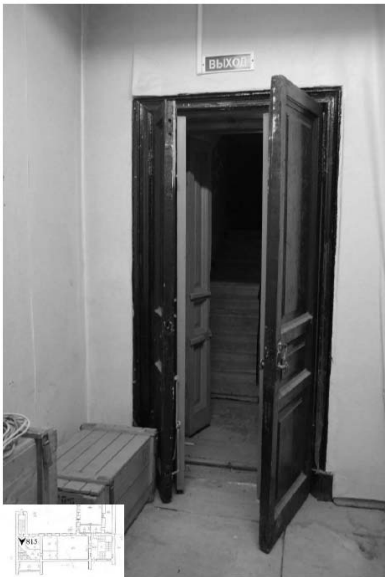
815. Этаж 5, помещение 31-Н. Дверь выхода на лестницу 2ЛК.
