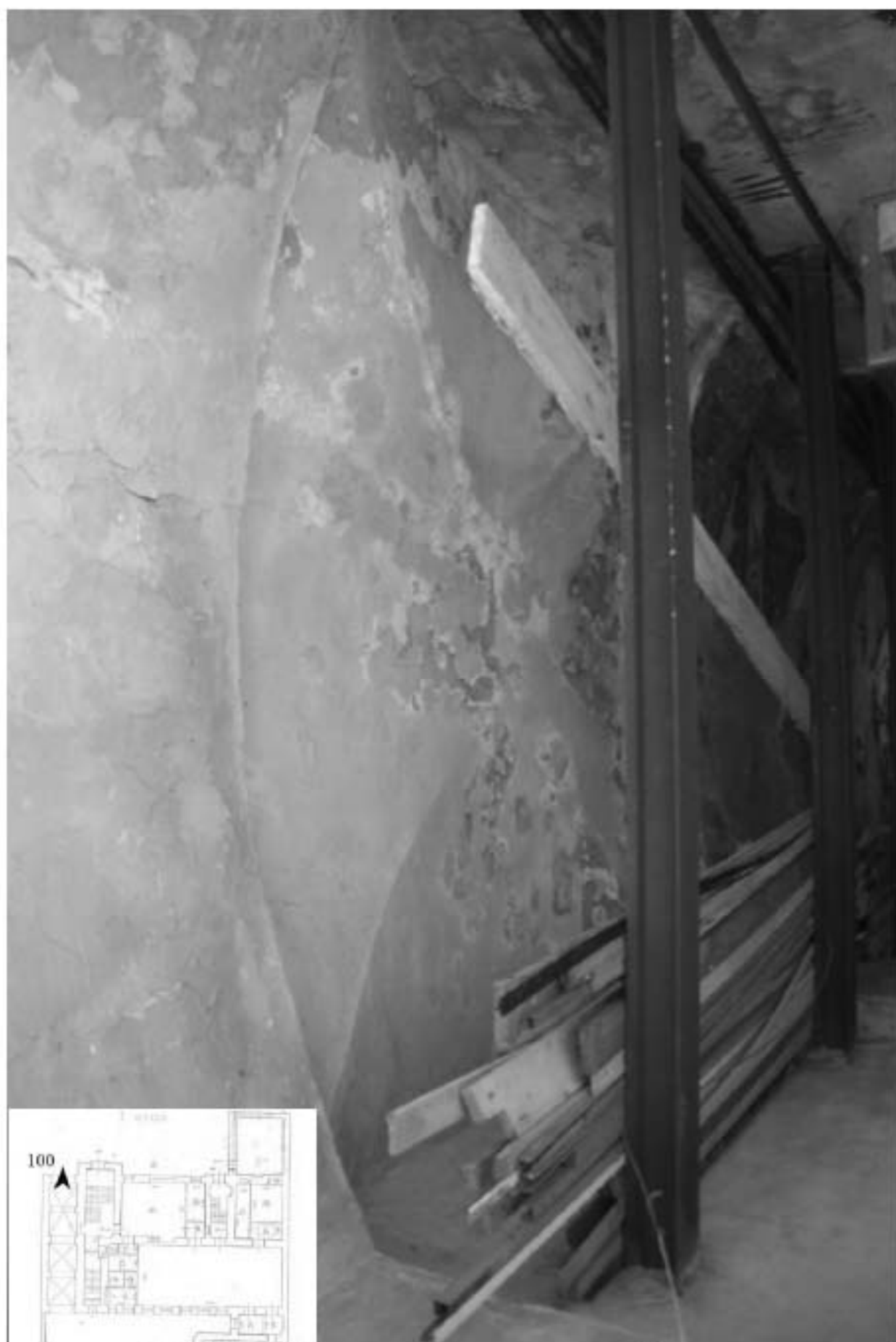
100. Воротный проезд дворового корпуса. Фрагмент.
