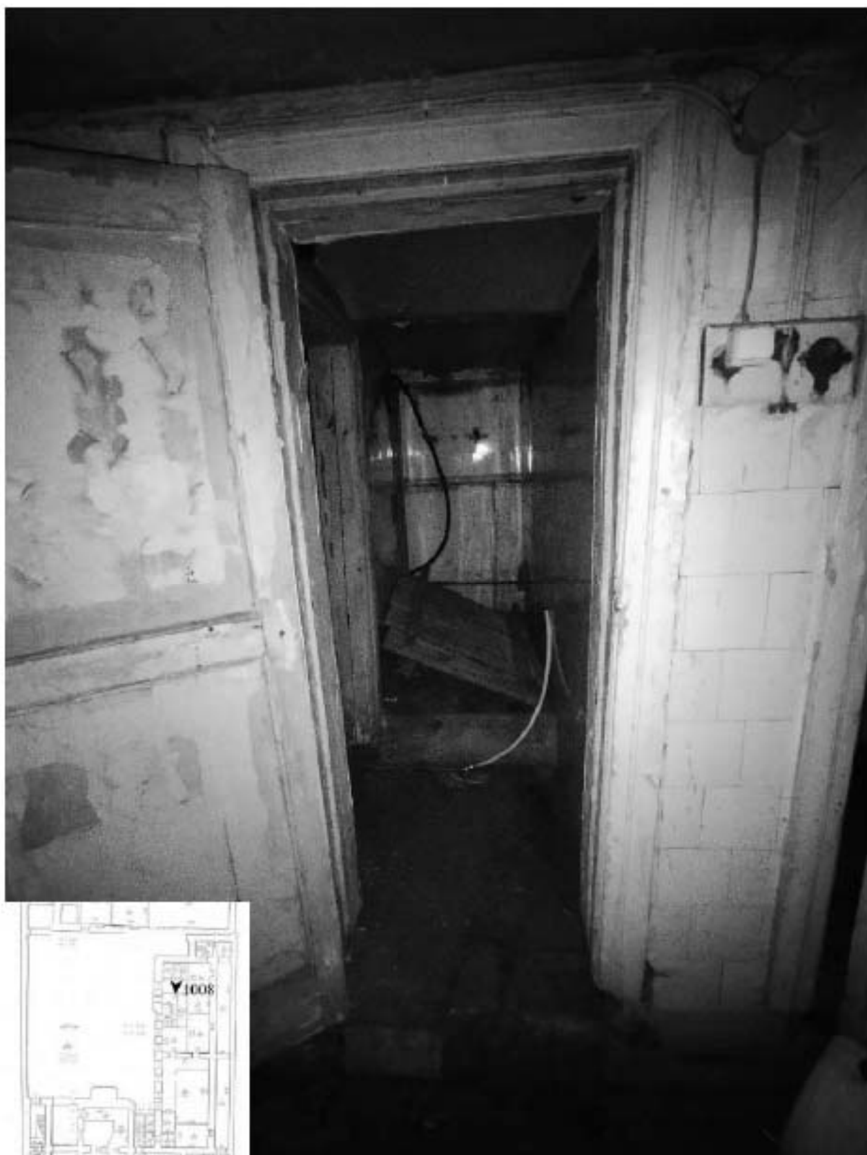
1008. Подвал, помещение 6-Н. Вход в комнату 1,7 кв.м.
