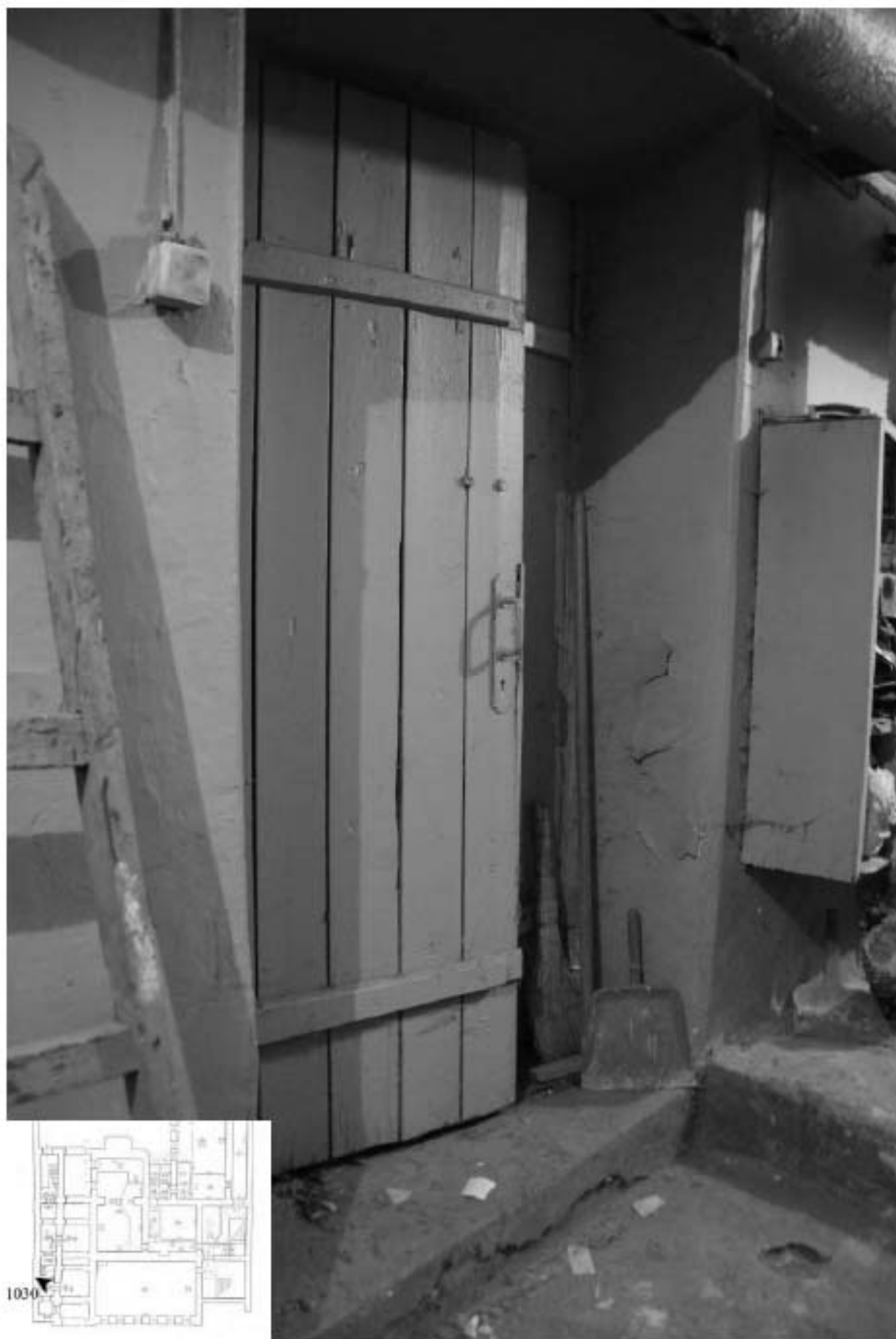
1030. Подвал, интерьер помещения 9-Н.
