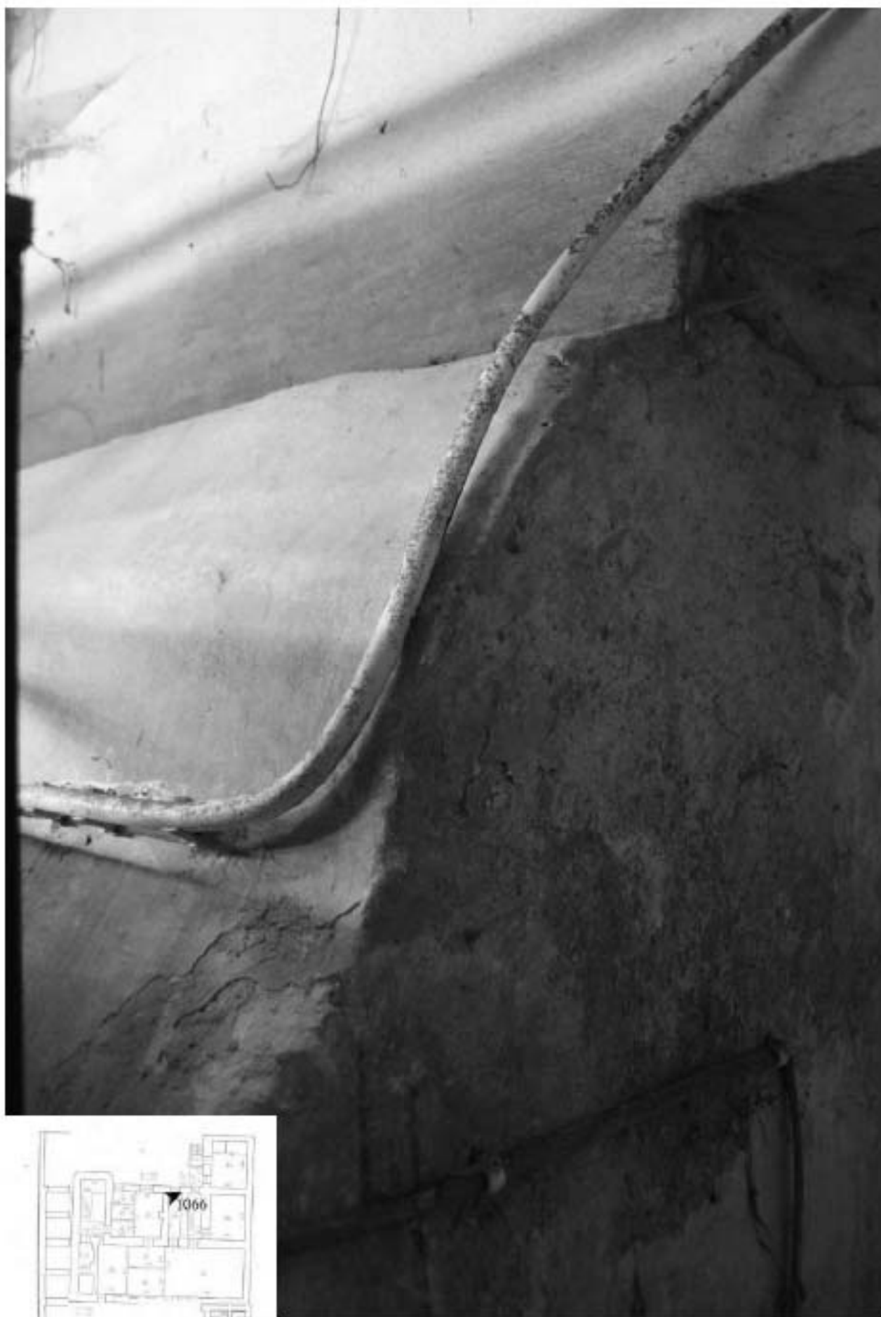
1066. Подвал, помещение 2-Н. Вид входного проёма в комнату 20,1 кв.м.
