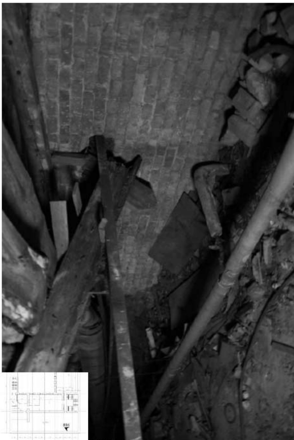
886. Этаж 5, интерьер чердака.
