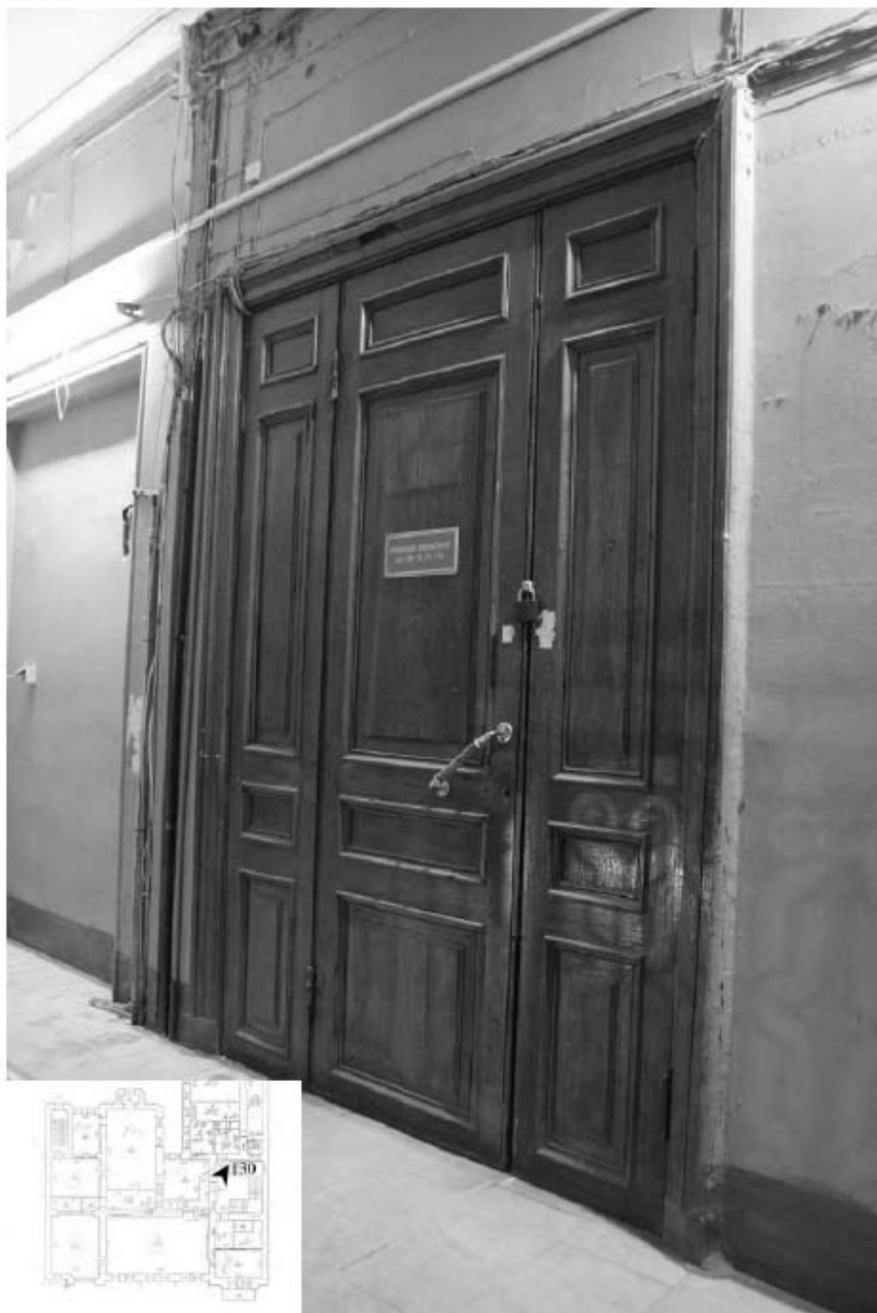
130. Вид на парадный вход в помещения 2 этажа.
