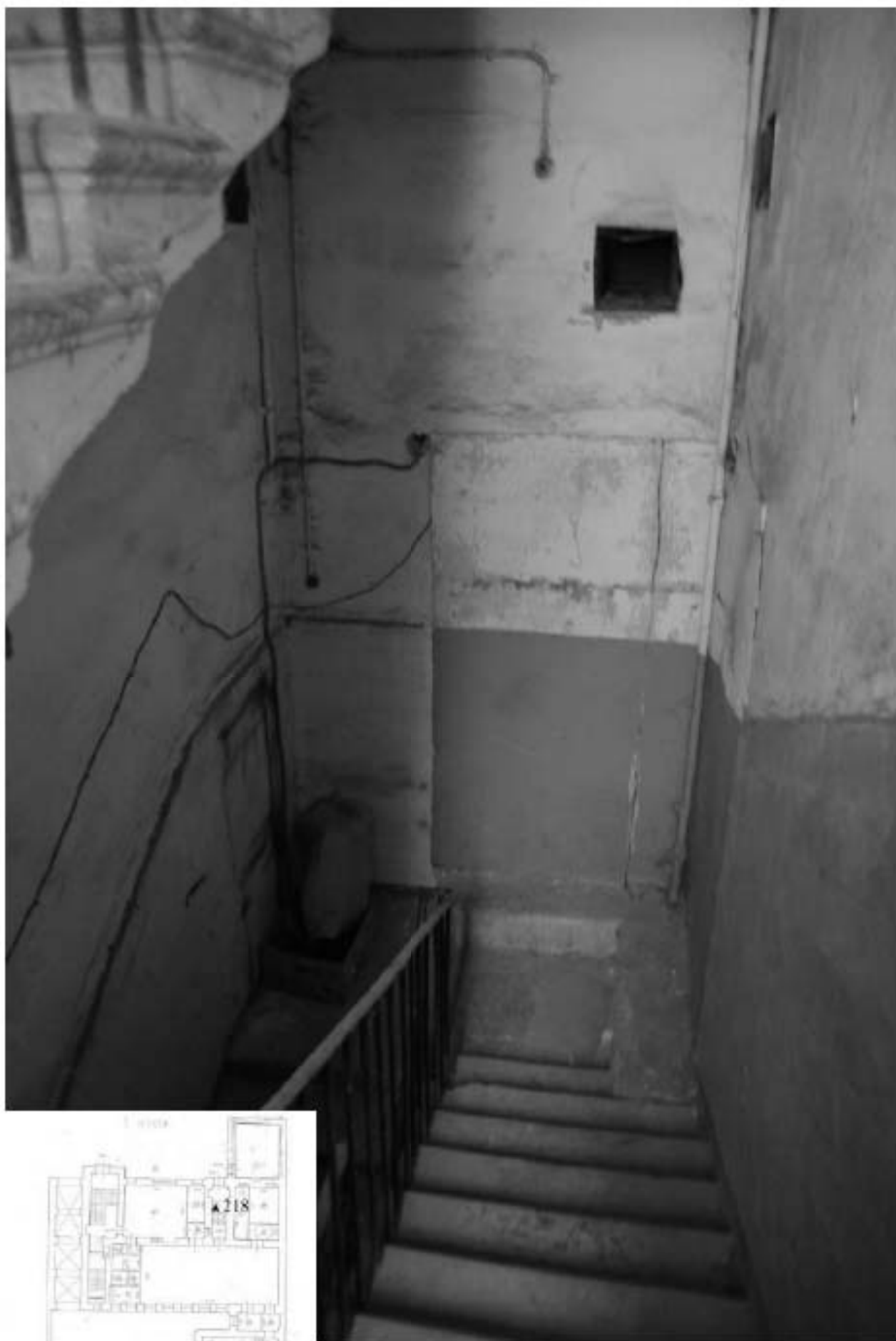
218. Лестница 4ЛК. Вид на лестничную площадку первого этажа.
