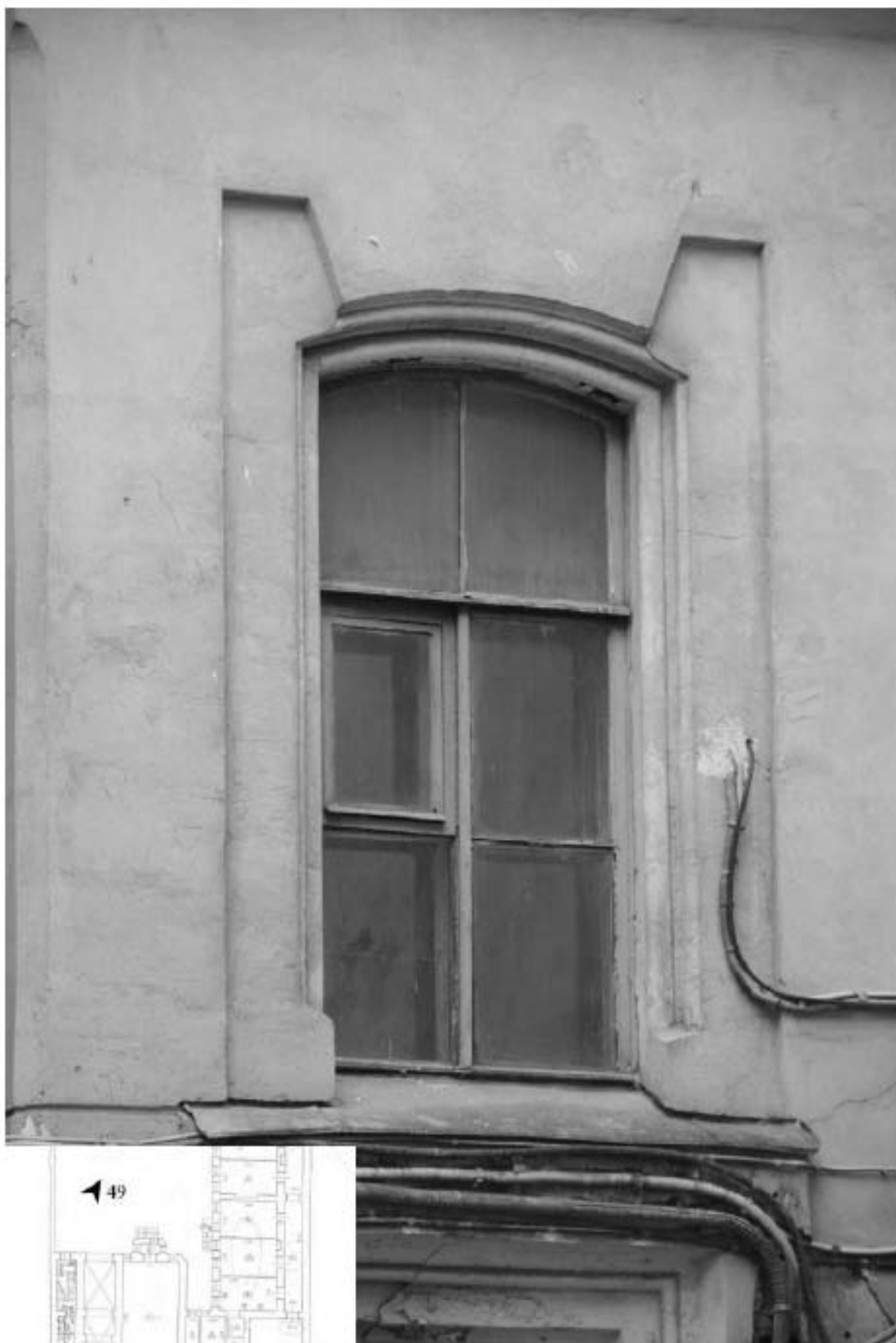
49. Фрагмент дворового фасада лицевого корпуса.
