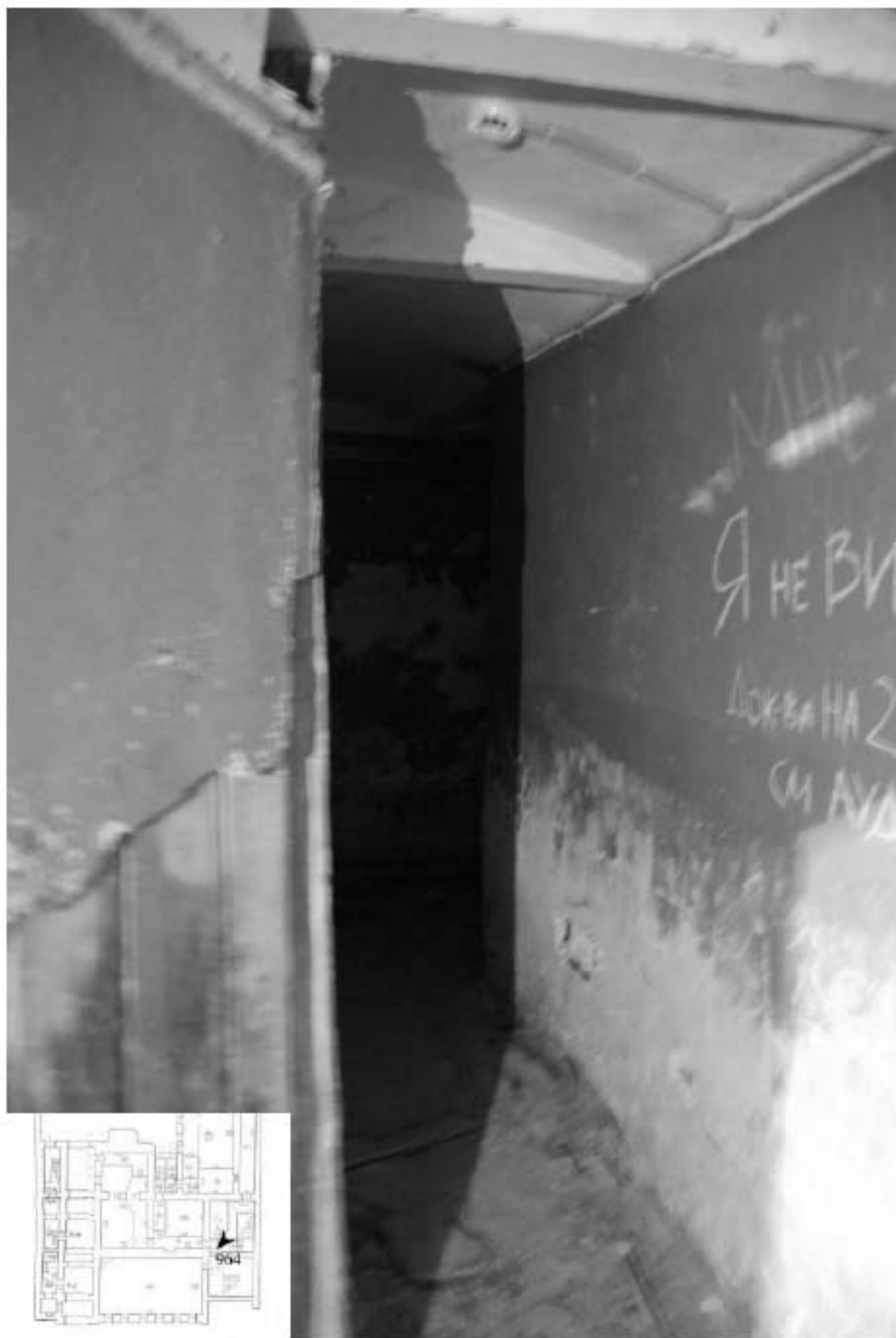
964. Подвал. Вход в помещение 29-Н.
