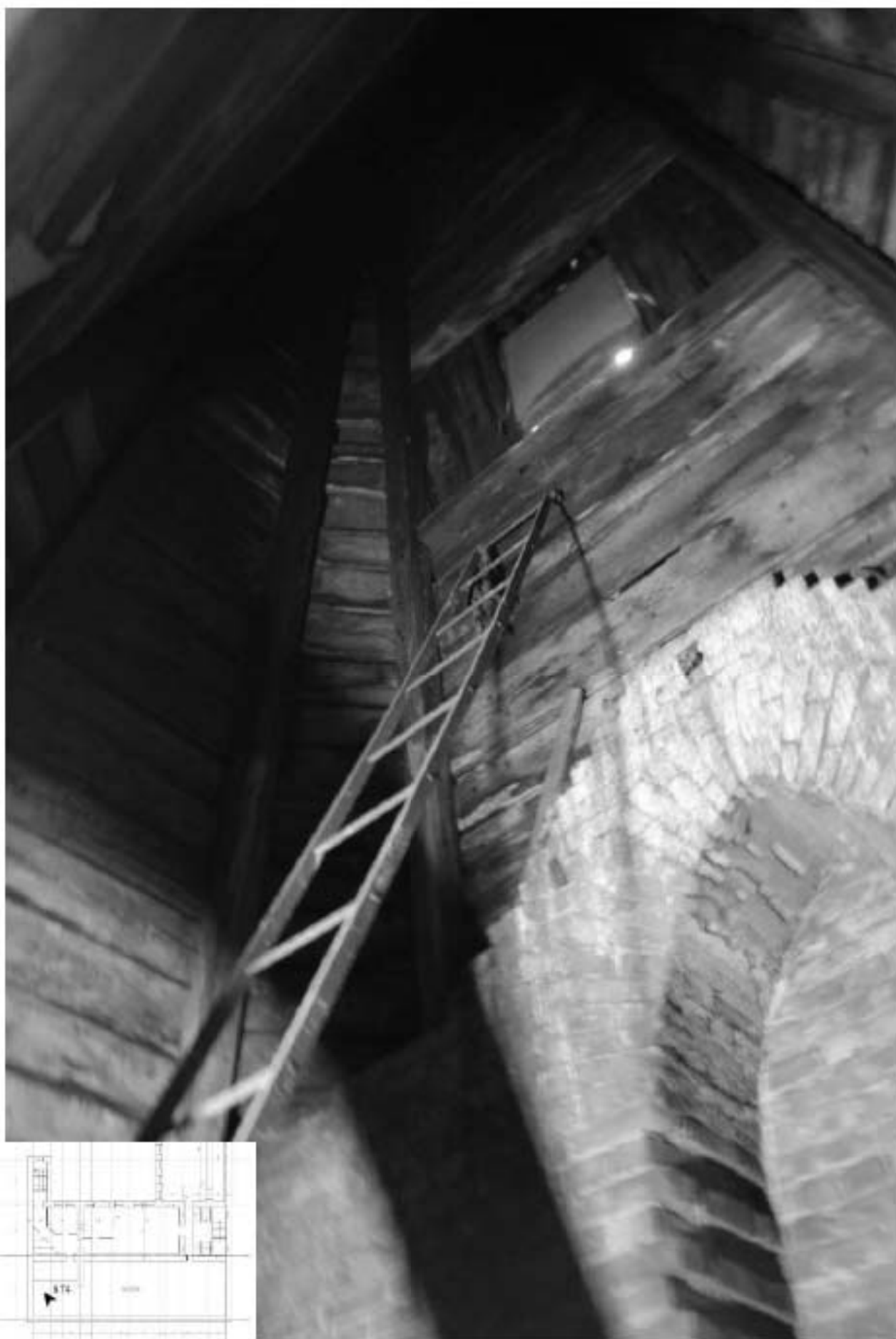
874. Этаж 5, интерьер чердака.
