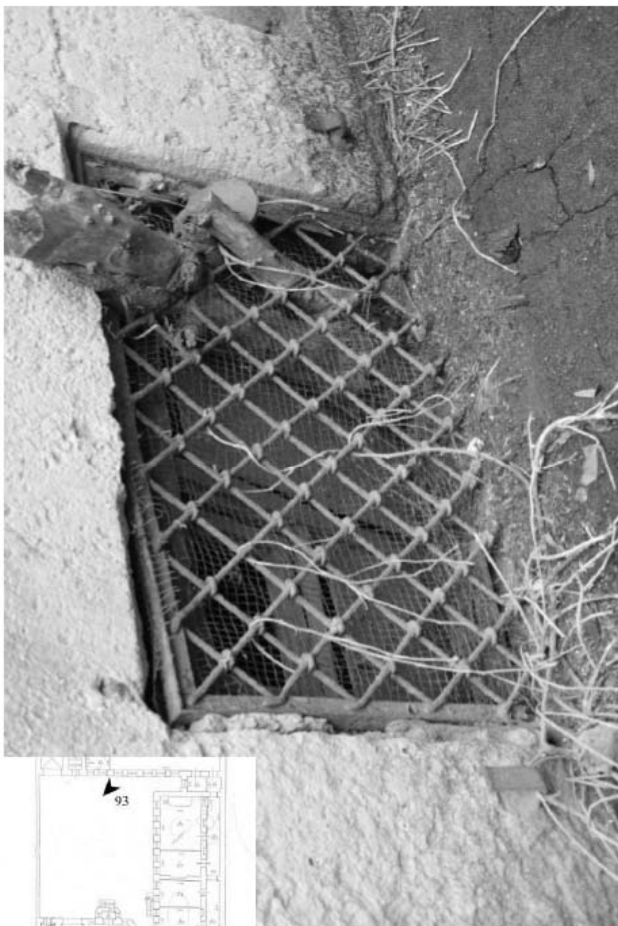
93. Фрагмент дворового фасада.
