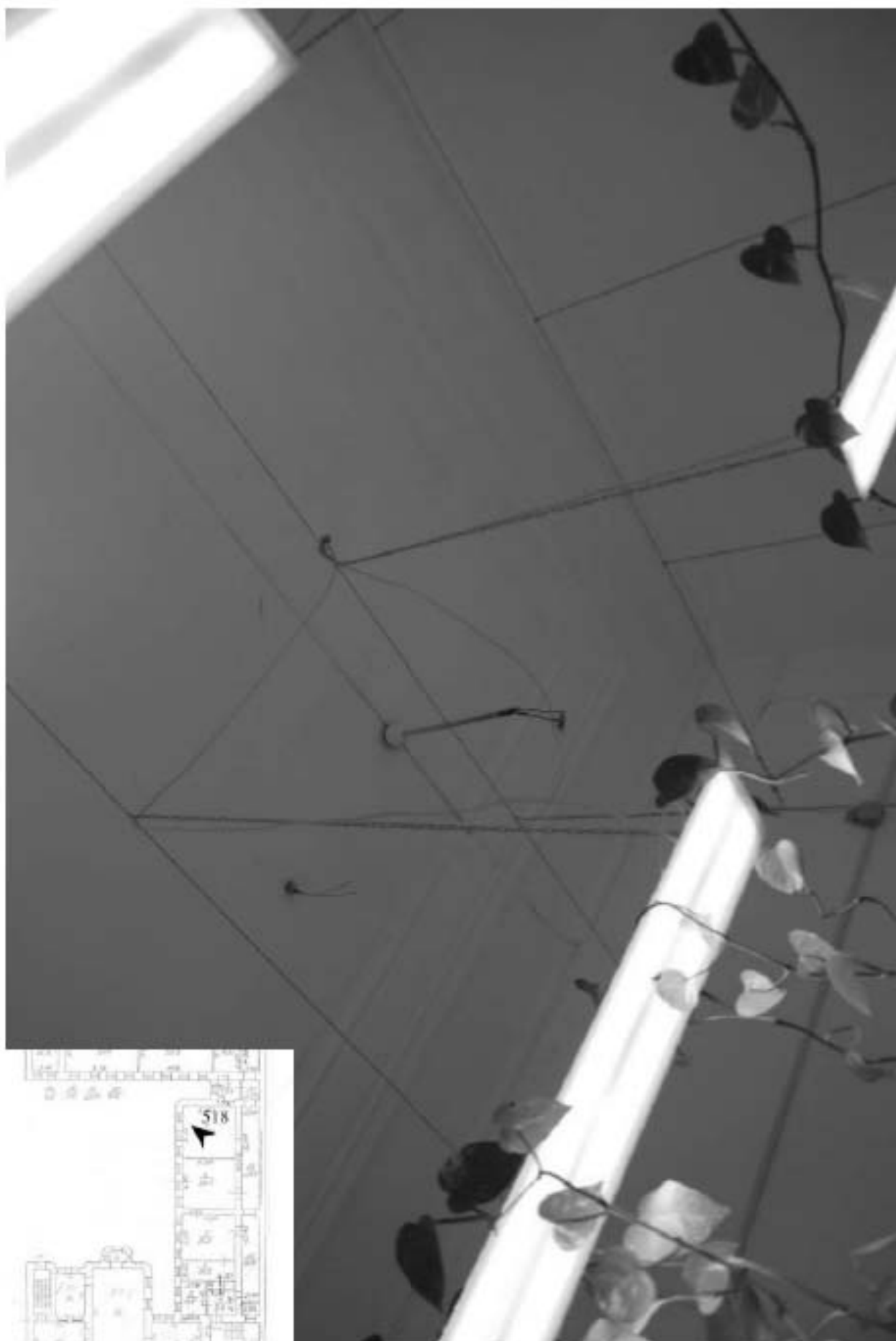
518. Этаж 2, помещение 16-Н. Интерьер комнаты 38,1 кв.м.
