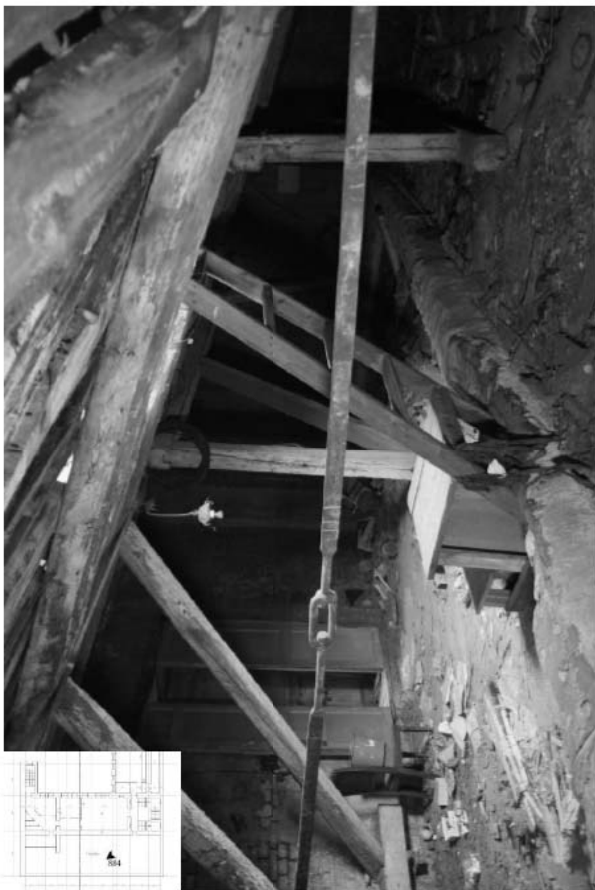
884. Этаж 5, интерьер чердака.
