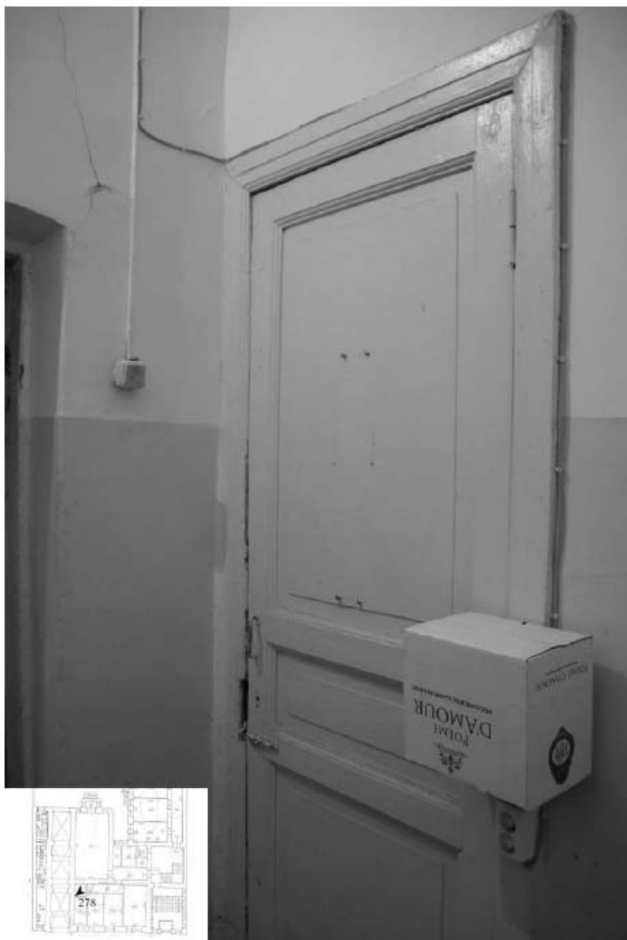
278. Этаж 1, помещение 20-Н. Интерьер комнаты 4,7 кв.м.
