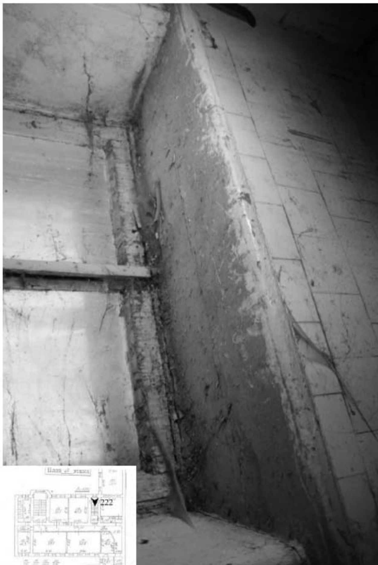
222. Лестница 4ЛК. Деревянный подоконник.
