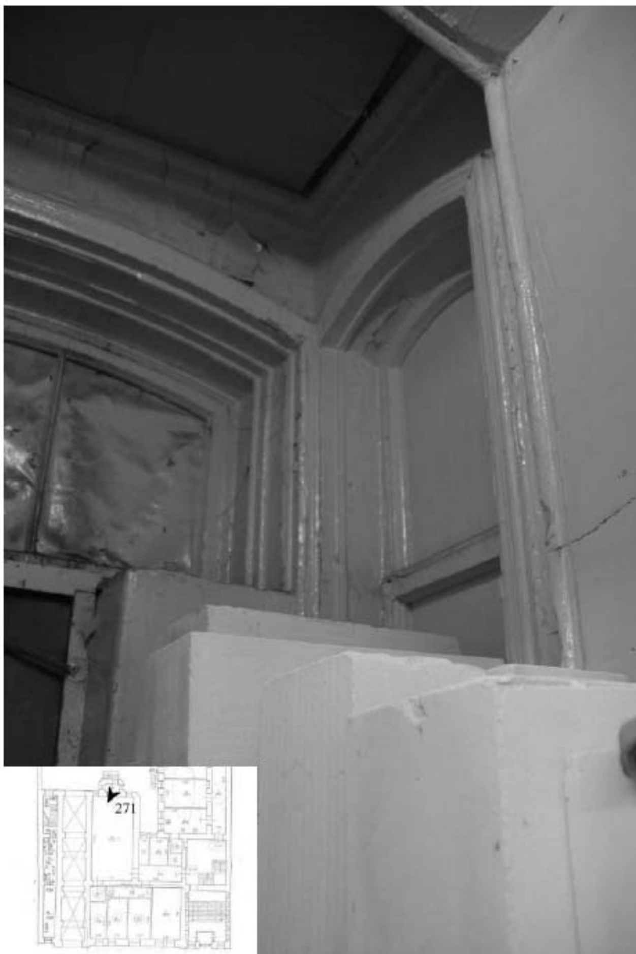
271. Этаж 1, помещение 20-Н. Интерьер входной группы.
