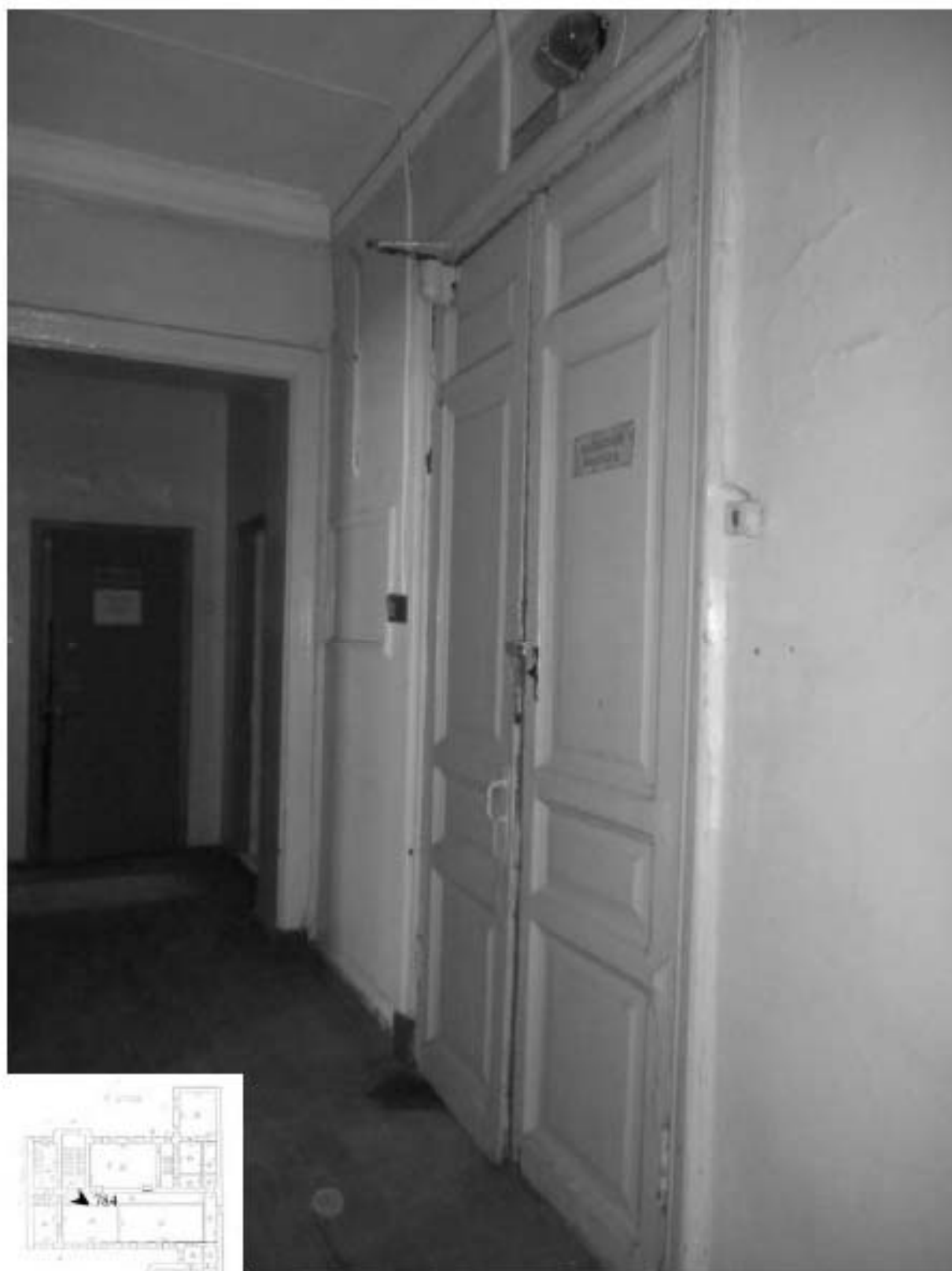
784. Этаж 4, помещение 40-Н. Дверь выхода на лестницу ЗЛК.
