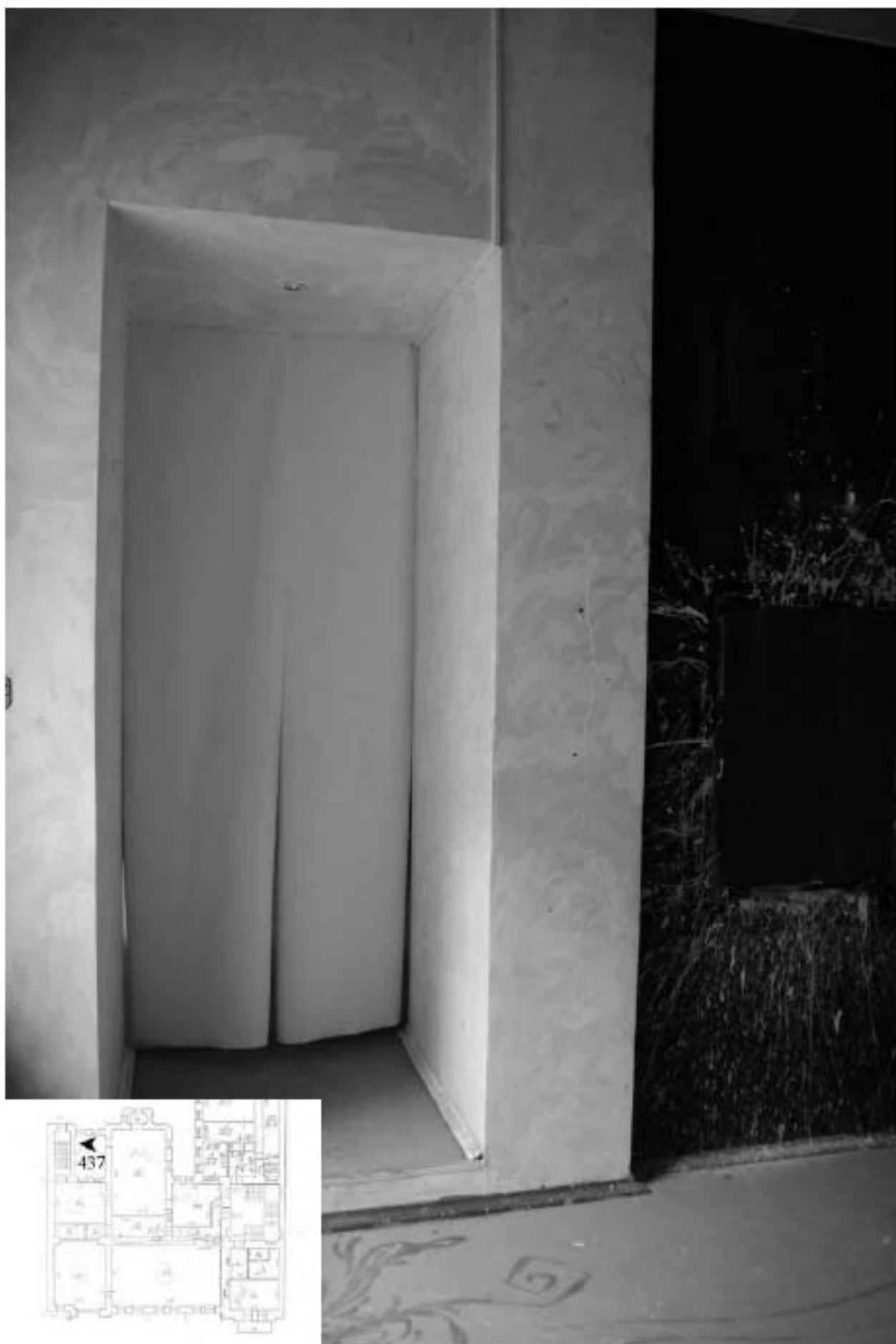
437. Этаж 2, помещение 26-Н. Интерьер комнаты 20,1 кв.м.
