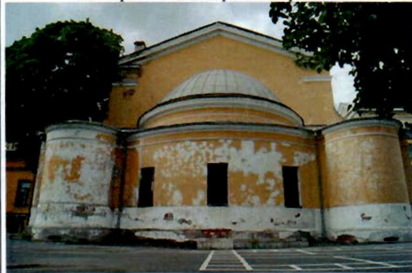
16. Фрагмент дворового фасада.
