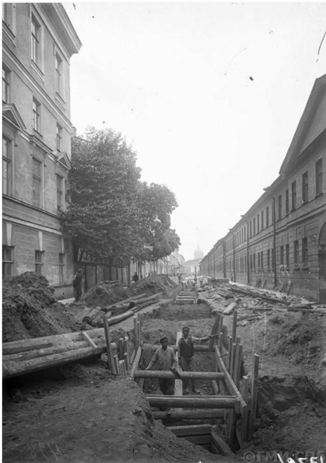
Илл. 10. Сооружение канализации. Траншейные работы на Чернышевском переулке (улице Ломоносова). 1920-1929 гг. https://pastvu.com/
