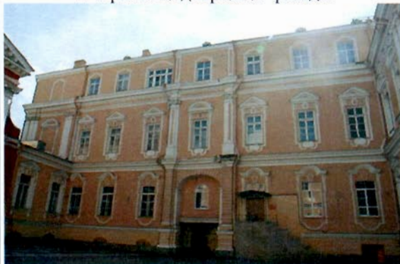
4. Фрагмент дворового фасада.
