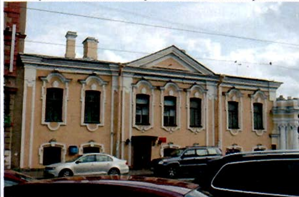
35. Фрагмент лицевого фасада восточного флигеля.
