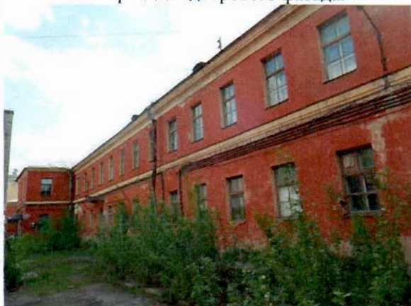
32. Фрагмент дворового фасада.
