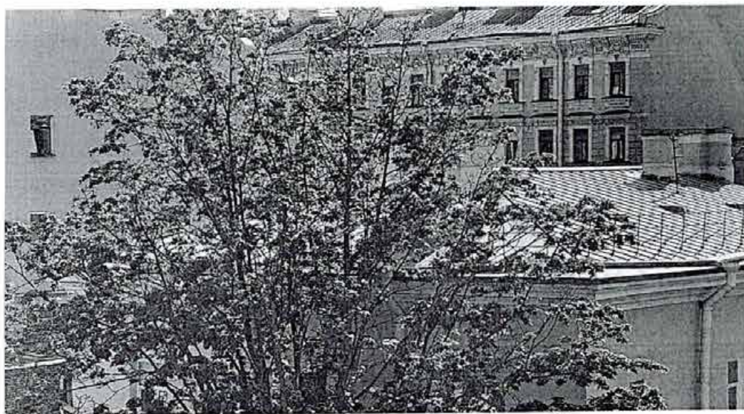
11. Фрагмент крыши корпуса лит.Б.
