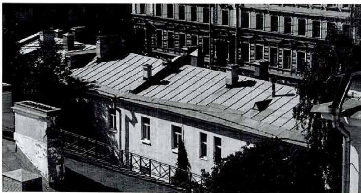
2. Крыша корпуса лит.Б
