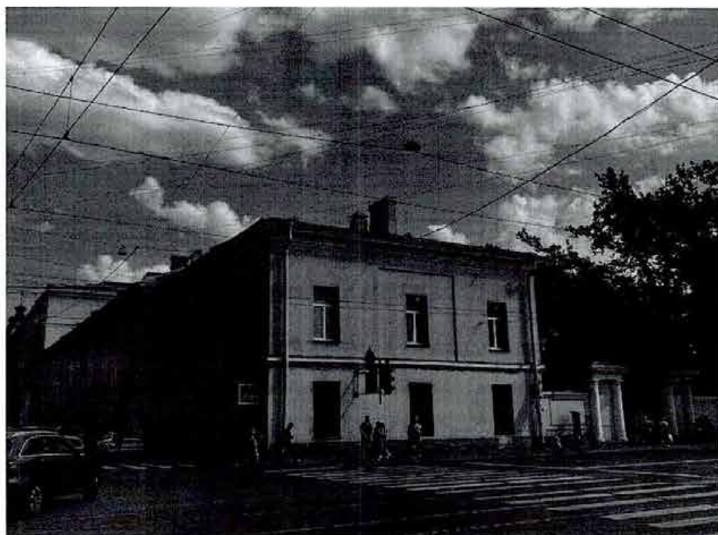
1. Лицевые фасады корпуса лит.Б
