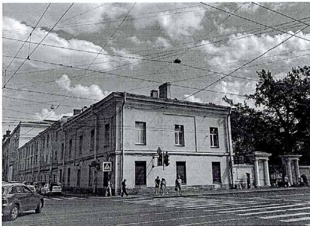
1. Лицевые фасады корпуса лит.Б
