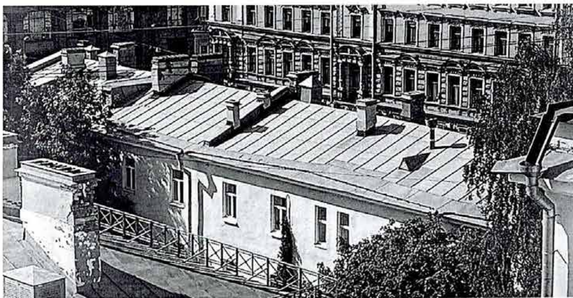
3. Крыша корпуса лит.Б
