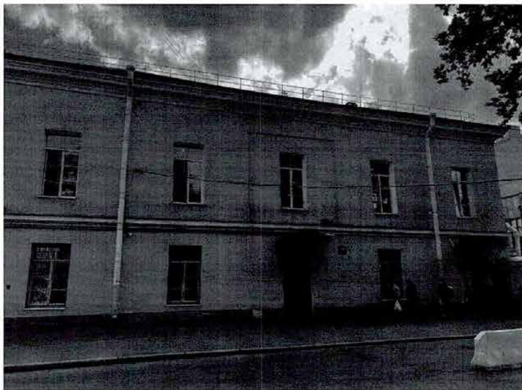
5. Фрагмент дворовых фасадов корпуса лит.В
