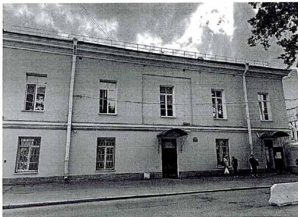
6. Фрагмент дворовых фасадов корпуса лит.В
