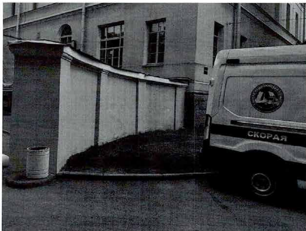
4. Ограда с северной стороны комплекса, примыкающая к Корпусу главному
