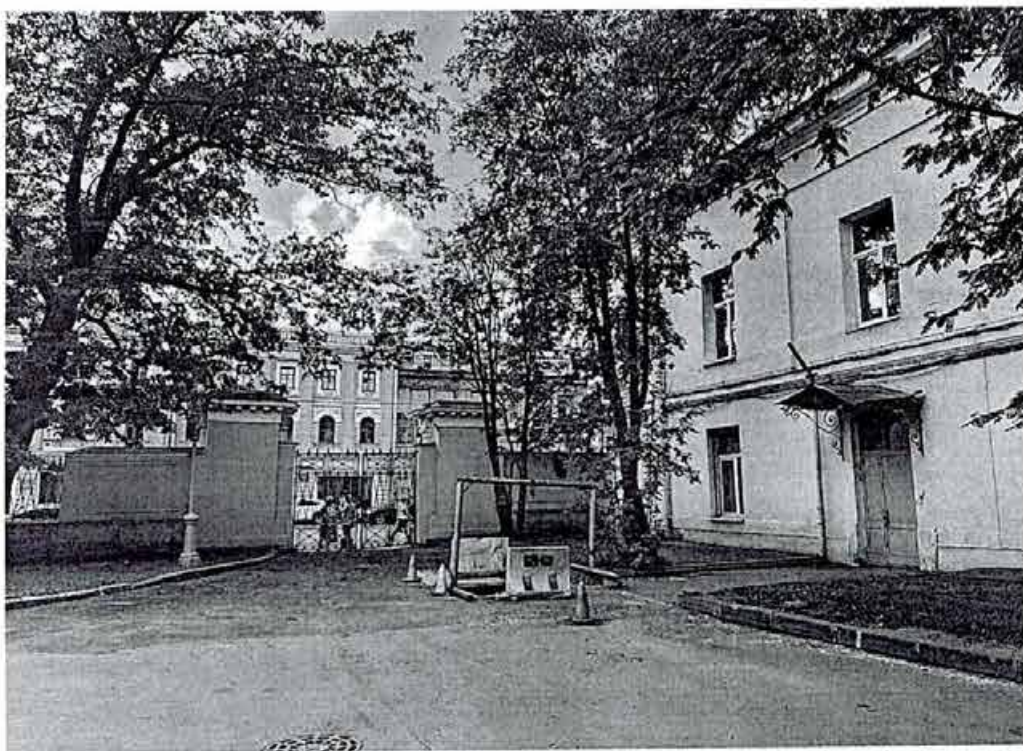
2. Дворовый фасад корпуса лит.Б
