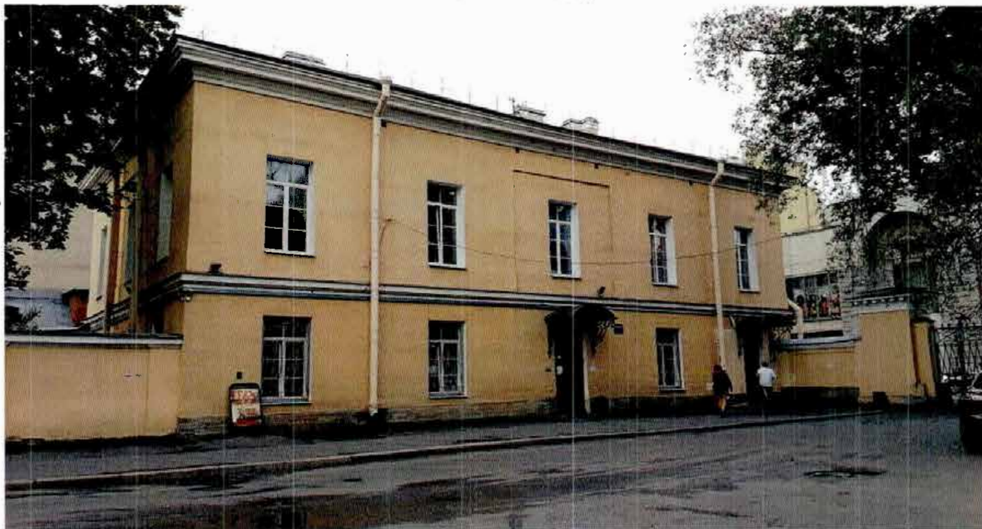
15. Северный фасад здания
