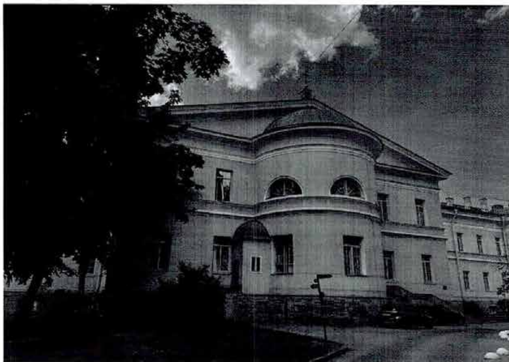
4. Фрагмент дворового фасада
