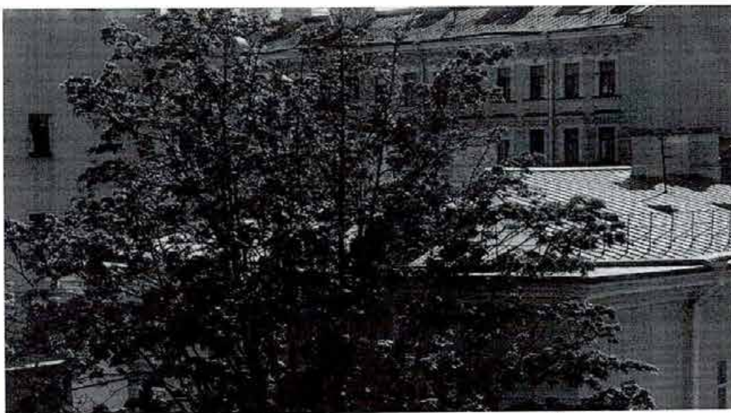
8. Фрагмент крыши корпуса лит.Б.
