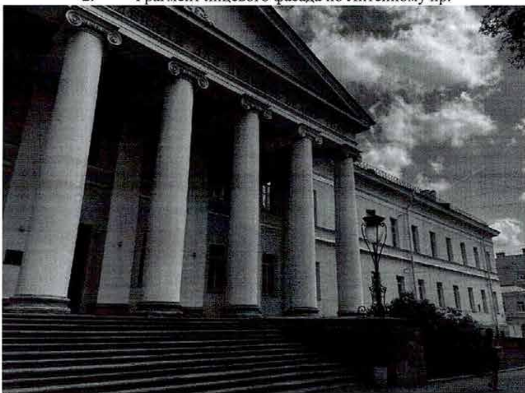
3. Фрагмент портика в центральной части лицевого фасада
