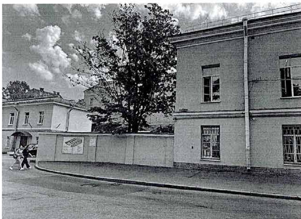
8. Фрагмент дворового фасадов корпуса лит.В
