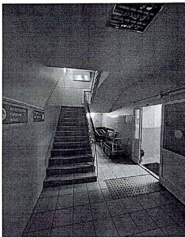
Фрагмент интерьеров 1-го этажа корпуса лит.Б
