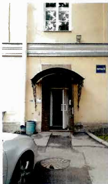
19. Вход с восточной стороны
