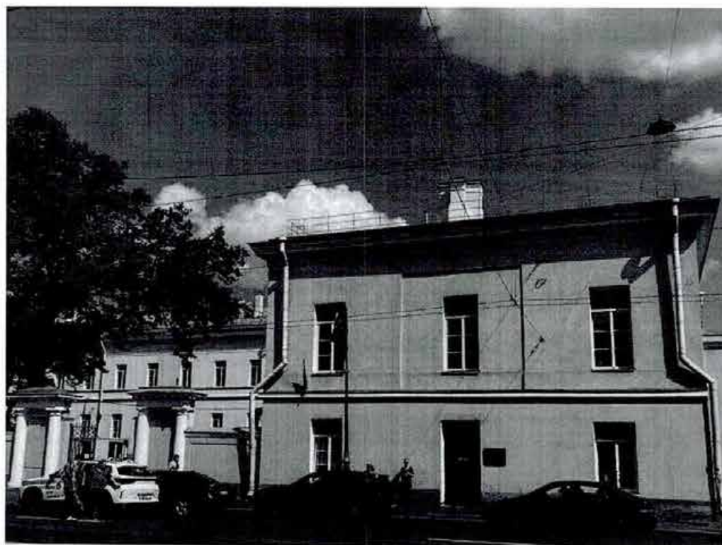
6. Лицевой фасад корпуса лит.В
