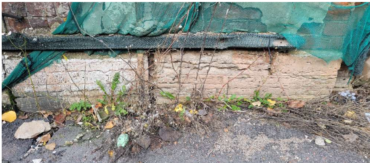
7. ОКНРЗ «Сельдяной ряд Никольского рынка», расположенный по адресу: Санкт-Петербург, Щепяной переулок, дом 4–6, литера А. Южный фасад со стороны Кустарного переулка. Материал облицовки цоколя – известняк.
