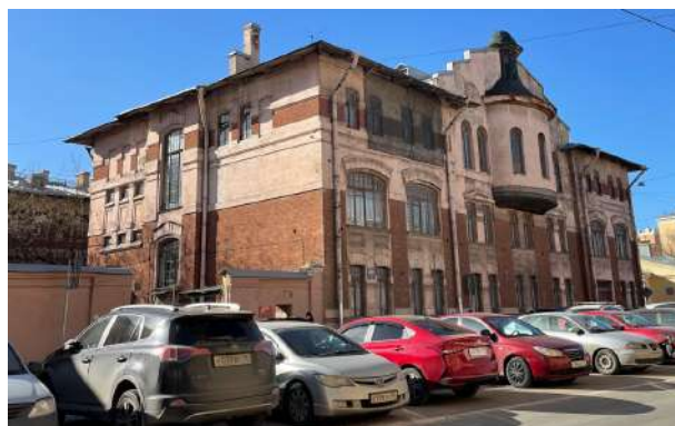
Илл. 4. Вид на здание по адресу: улица Красного Курсанта, 32, литера А
