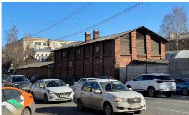
Илл. 17. Вид на здание по адресу: улица Красного Курсанта, 36, литера Б с Новолажожской улицы
