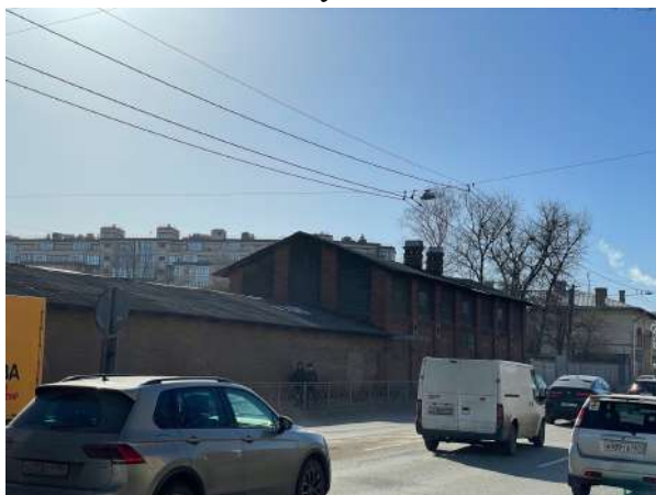
Илл. 19. Вид на здание по адресу: улица Красного Курсанта, 36, литера Б с Новолажожской улицы
