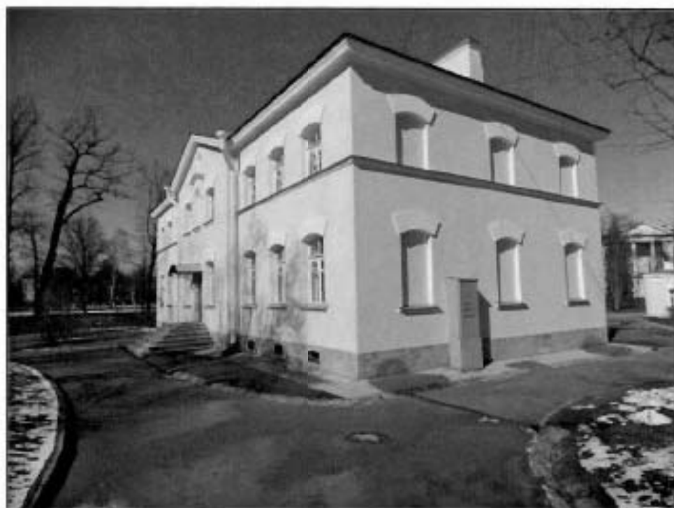
13. Южный фасад здания.
