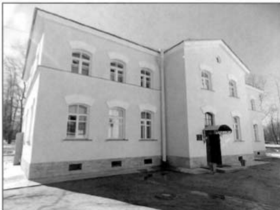
12. Северо-восточный фасад здания.
