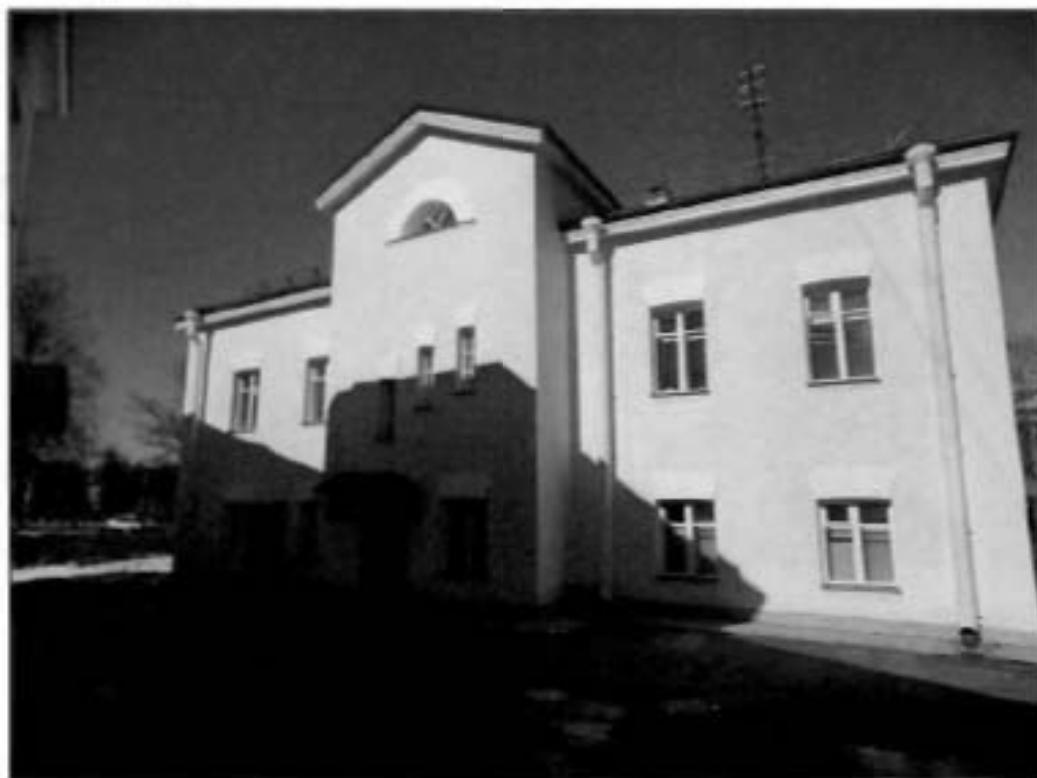
16. Южный фасад здания.
