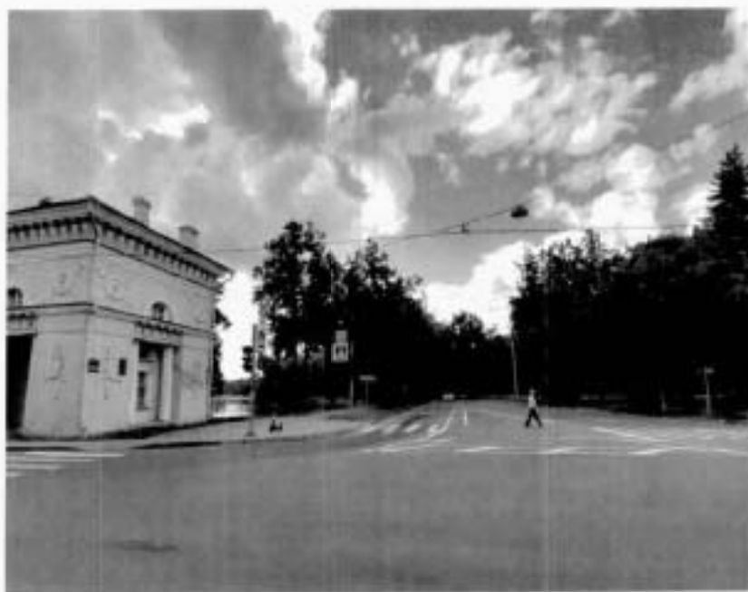
Фото 14 Фрагмент объекта культурного наследия. Вид с севера. Участок Бульвара (от Советского переулка до Московского шоссе)
