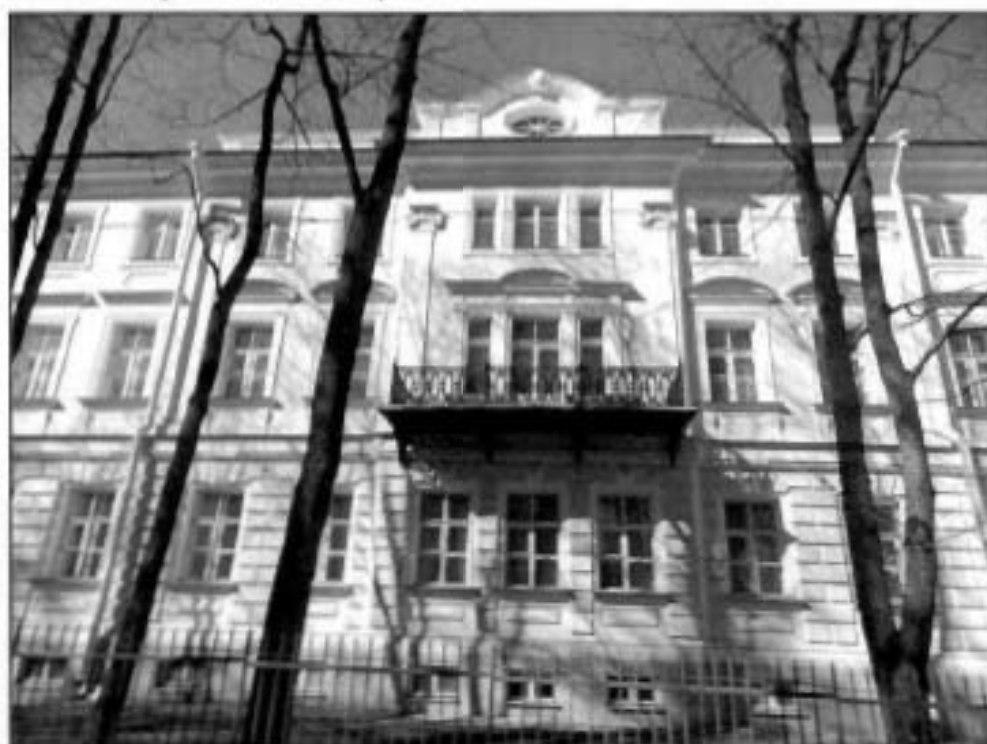
3. Юго-восточный фасад здания. Фрагмент.
