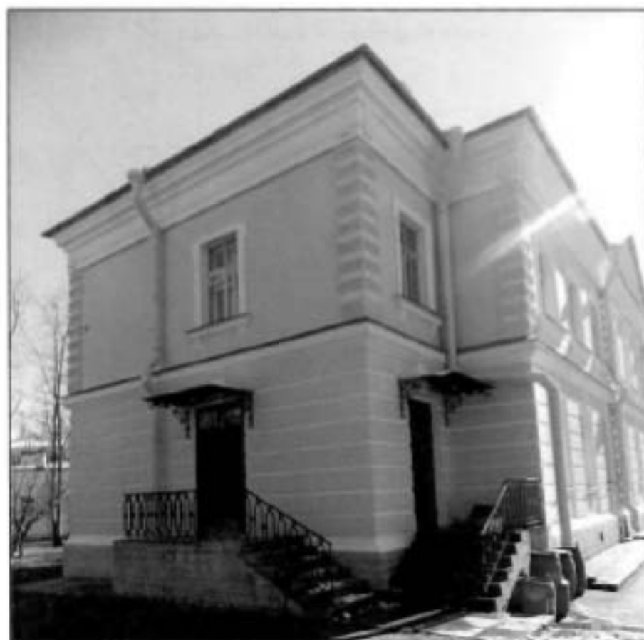
22. Северо-восточный фасад здания.
