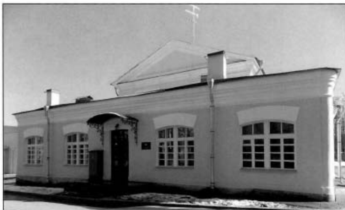
24. Северный фасад здания.
