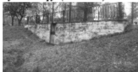
Водосливная плотина на пруду
