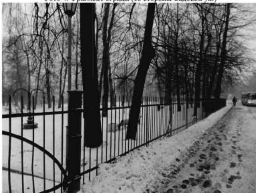
Фото 4. Фрагмент ограды (со стороны Садовой ул.)
