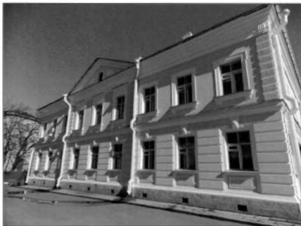
21. Северо-западный фасад здания.
