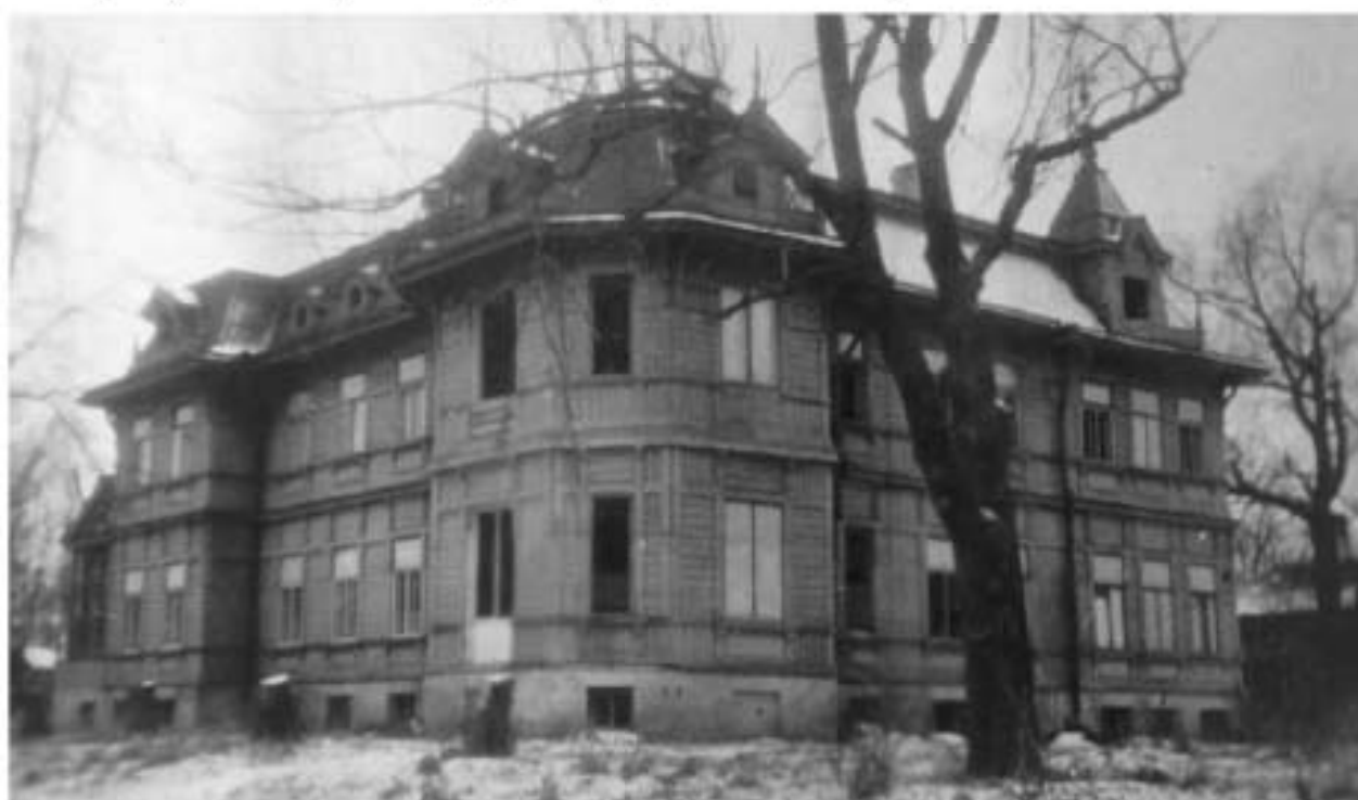
9. Главный дом усадьбы П.Р. Багратиона. Фотография конца 1940-х гг. В процессе реконструкции под детские ясли. // Из фондов историко-литературного музея города Пушкина.
