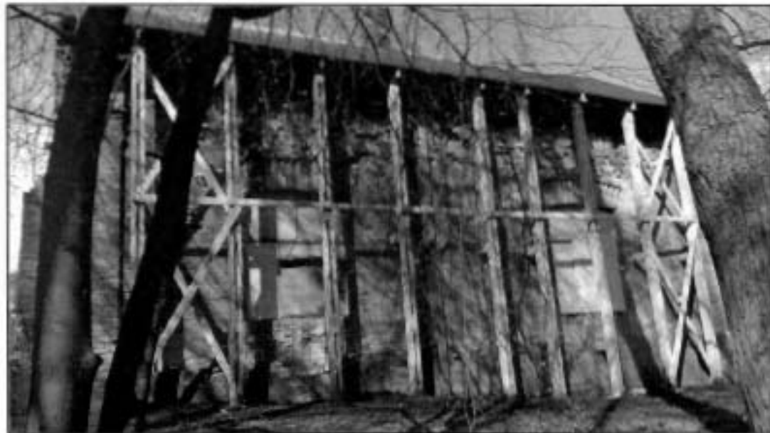
9. Юго-восточный фасад здания.
