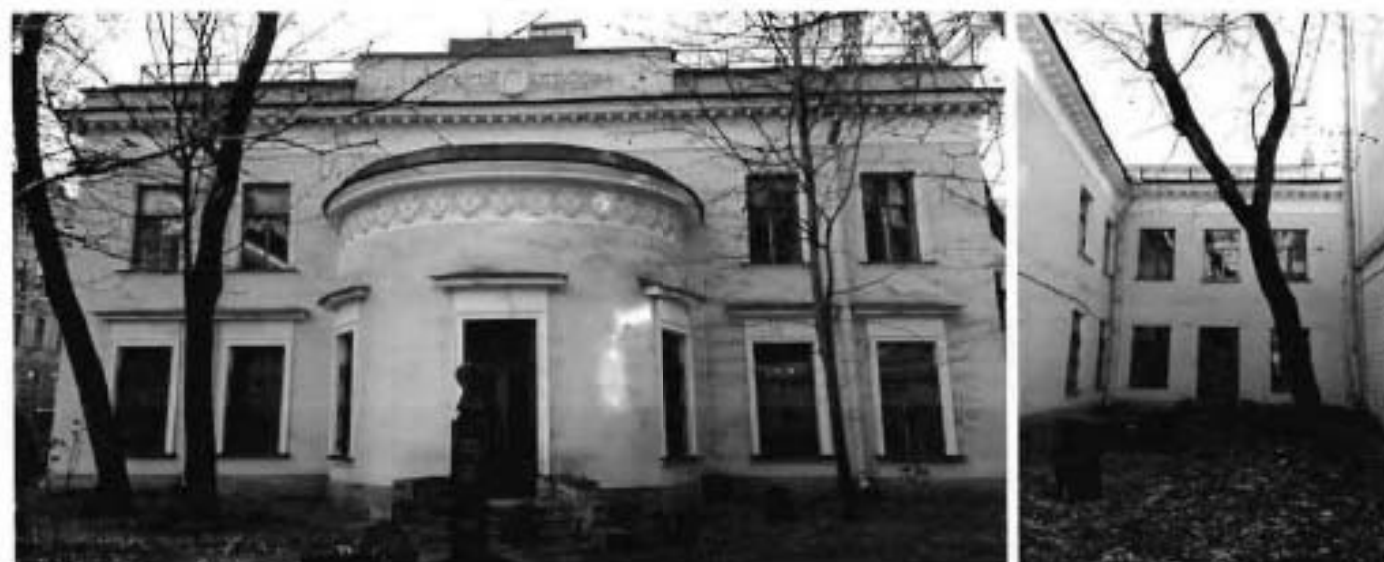
2, 3. Восточный фасад здания
