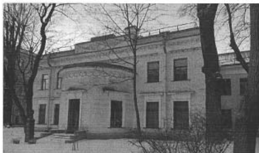
5. Лицевой фасад со стороны Московского пр.
