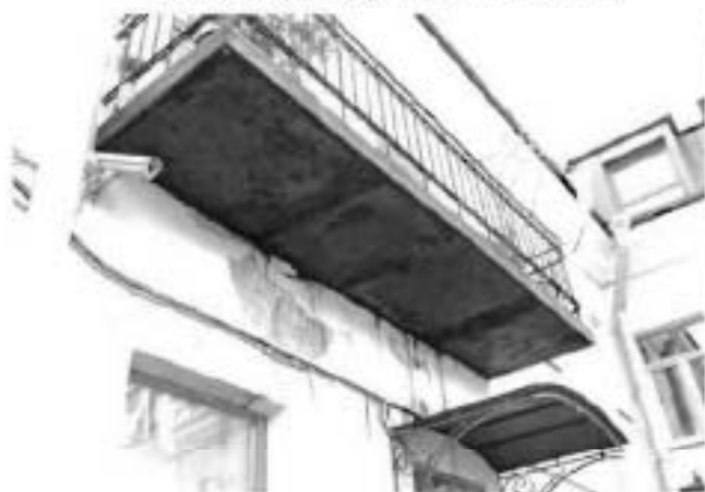
16. Балкон в уровне 2-го этажа
