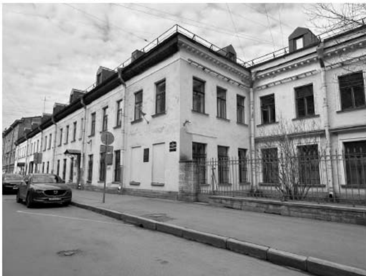
Фото 2. Общий вид здания по 4-ой Красноармейской ул.
