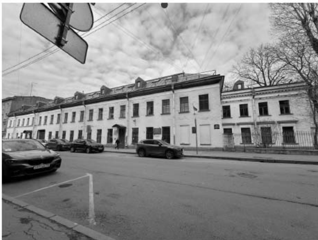
Фото 1. Общий вид здания по 4-ой Красноармейской ул.
