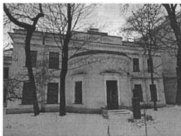
6. Лицевой фасад со стороны Московского пр.
