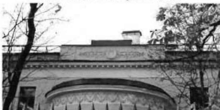
5. Аттик восточного фасада здания
