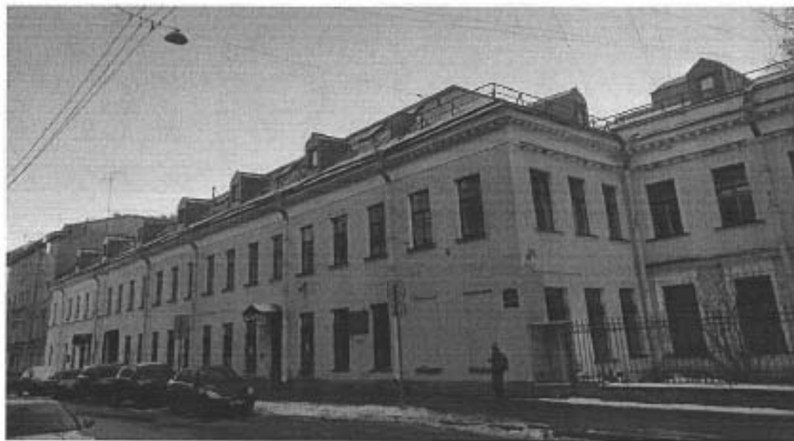
2. Лицевой фасад со стороны ул. 4-я Красноармейская
