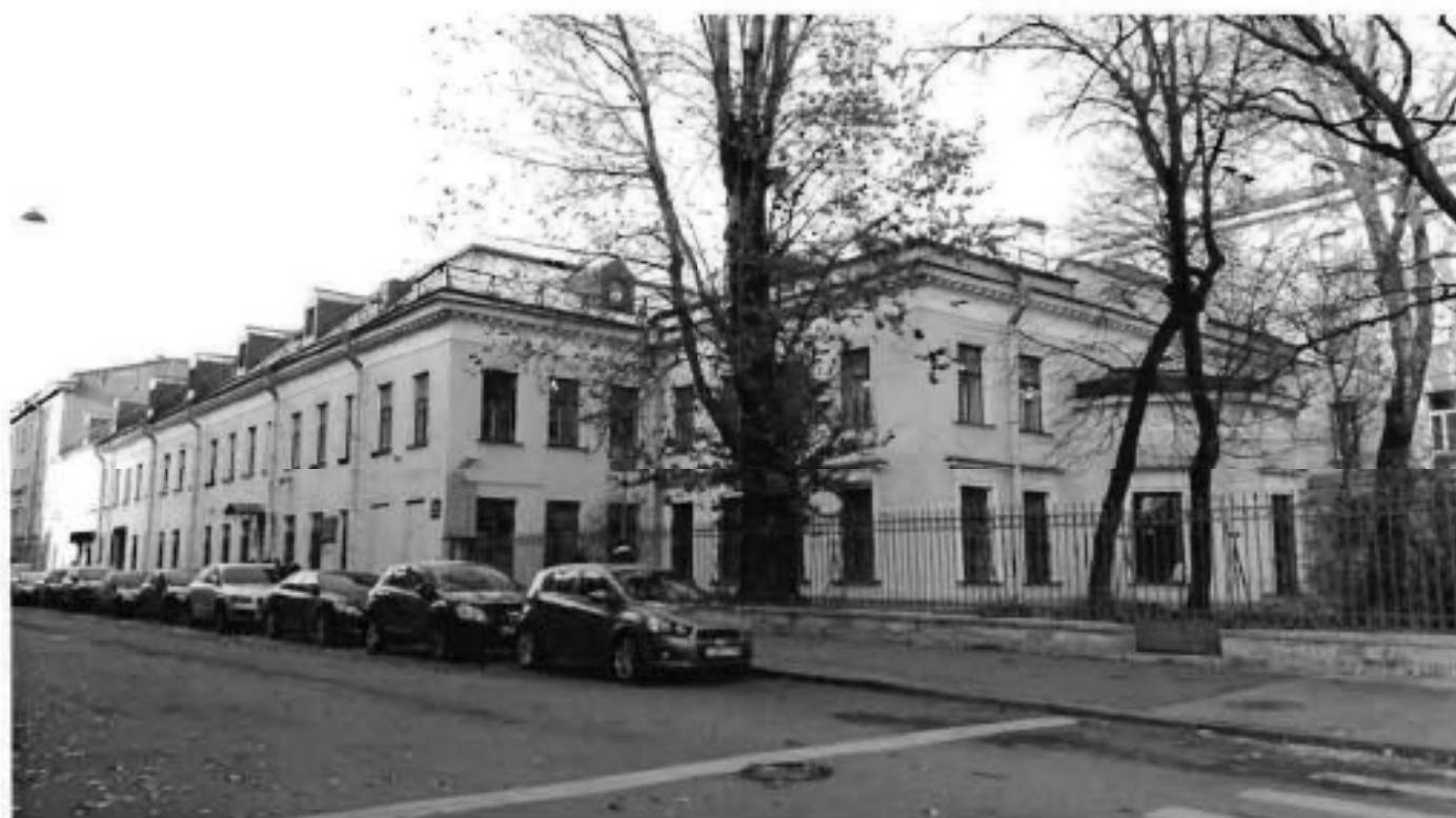
1. Вид с юго-восточной стороны
