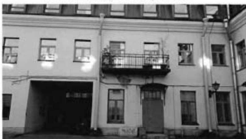
17. Вид на южную часть флигеля
