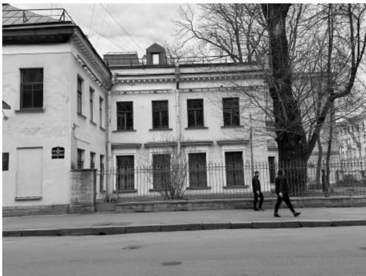
Фото 3. Вид здания по 4-ой Красноармейской ул.
