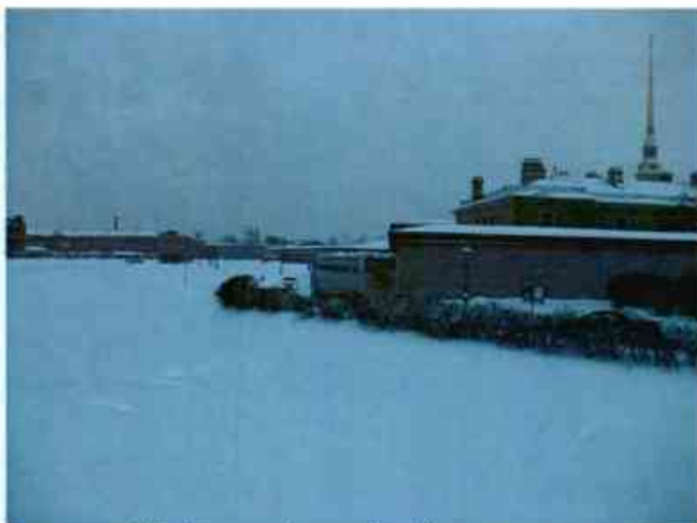
5. Левобережная набережная. Вид с Кронверкского моста
