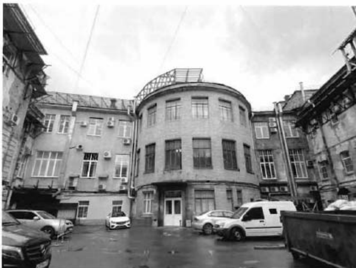
2. Общий вид на объект культурного наследия.
