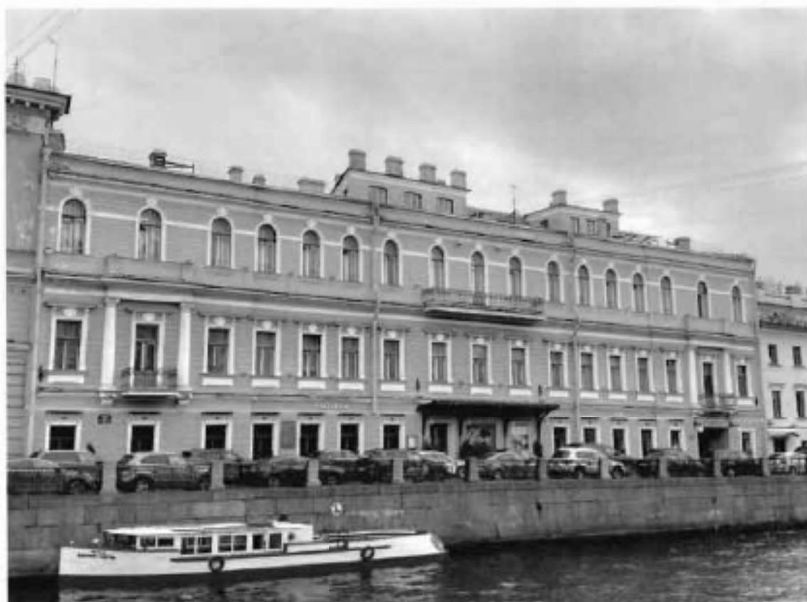
1. Общий вид на объект культурного наследия.
