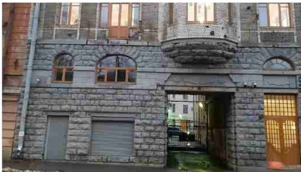
25. «Дом и службы» (в составе «Дом и особняк полковника Ф.Г. Козлянинова с садом, палисадником, оградой») (Писарева ул., д. 10, лит. В). Лицевой фасад (фрагмент). Фото мест установки оборудования и кабельных трасс. Штиглиц М.С. 26.12.2024.
