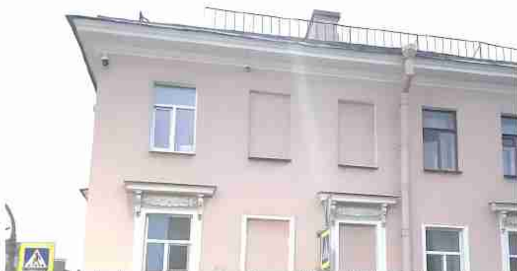
41. «Дом Панфилова» (Лермонтовский пр., д. 27, лит. А). Лицевой фасад (фрагмент). Фото мест установки оборудования и кабельных трасс. Штиглиц М.С. 26.12.2024.
