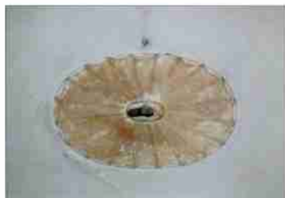
22. Оформление потолка (прихожая, помещение № 9). Четвертый этаж.
