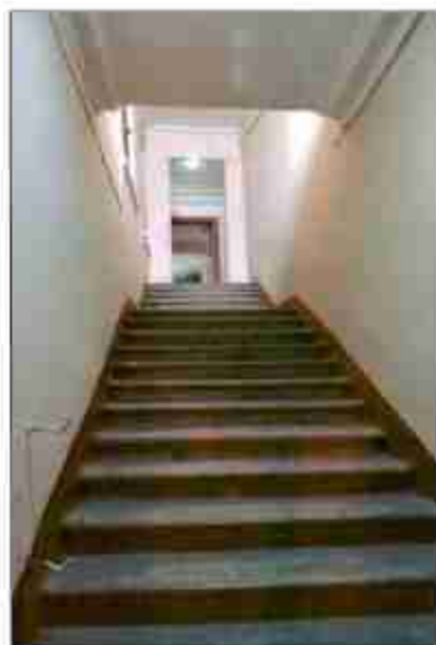
4. Интерьер. Фрагмент. Восточная лестница
