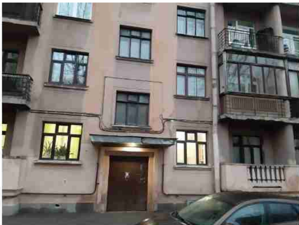
53. «Жилой дом работников Союзверфи» (Декабристов ул., д. 29, лит. Б). Дворовые фасады. Фото мест установки оборудования и кабельных трасс. Штиглиц М.С. 26.12.2024.
