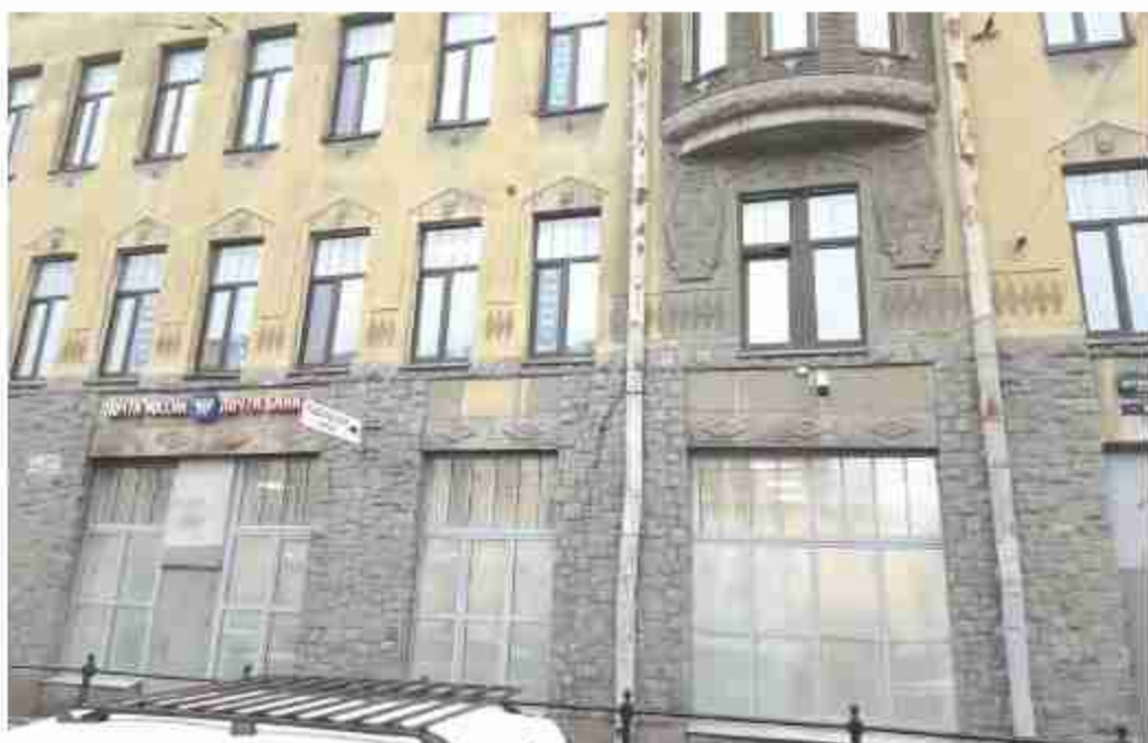
9. «Дом В.В. Васильевой» (Подольская ул., д. 1-3-5, лит. А). Лицевой фасад (фрагмент). Фото мест установки оборудования и кабельных трасс. Штиглиц М.С. 26.12.2024.
