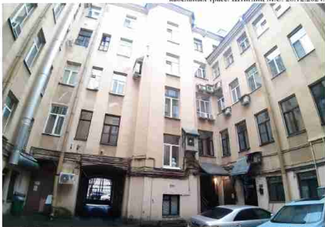
30. «Доходный дом» (в составе «Особняк и доходный дом К.Л. Миллера») (Якубовича ул., д. 2, лит. А). Дворовые фасады. Фото мест установки оборудования и кабельных трасс. Штиглиц М.С. 26.12.2024.
