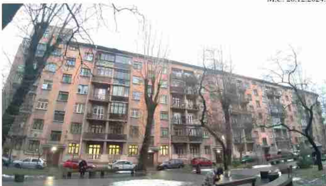
52. «Жилой дом работников Союзверфи» (Декабристов ул., д. 29, лит. Б). Дворовые фасады. Фото мест установки оборудования и кабельных трасс. Штиглиц М.С. 26.12.2024.
