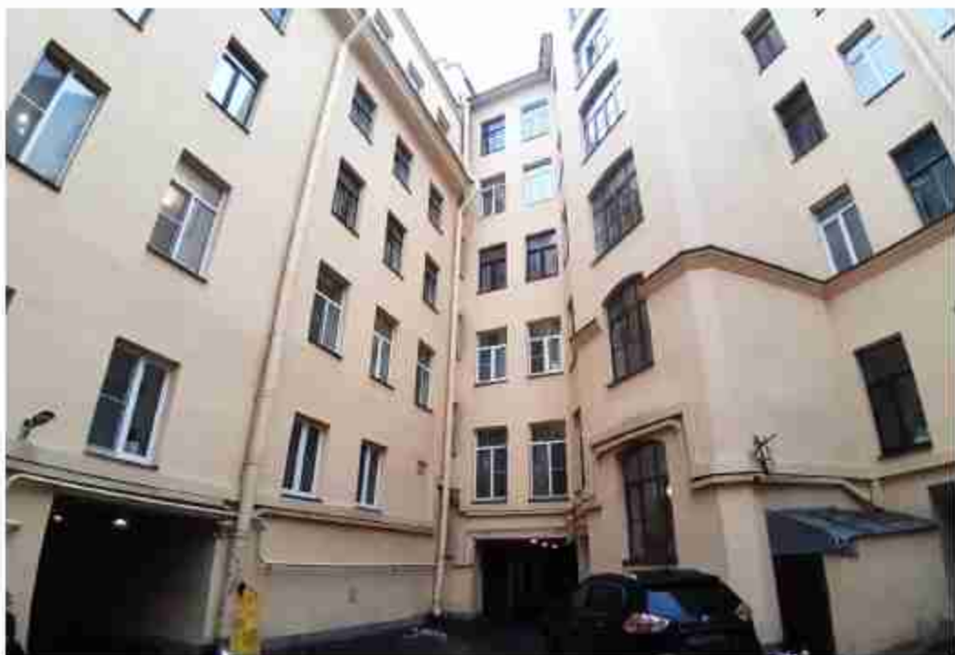
17. «Дом И. Вальха, в котором в 1816-1818 годах жил А.С. Грибоедов» (Средняя Подъячская ул., д. 15, лит. А). Дворовые фасады. Фото мест установки оборудования и кабельных трасс. Штиглиц М.С. 26.12.2024.
