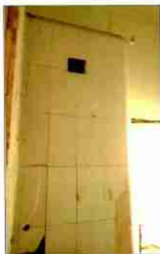
19. Печь (коридор, помещение № 10). Третий этаж. Фрагмент.
