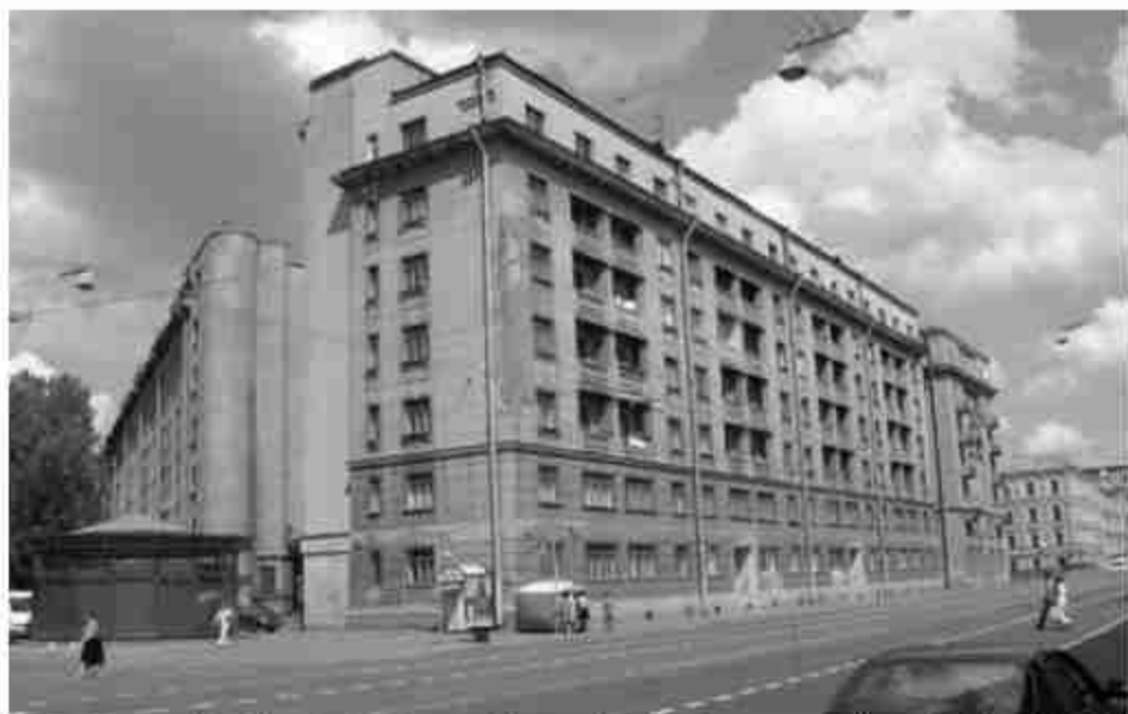
41. «Жилой дом работников Союзверфи» (Декабристов ул., д. 29, лит. Б). Фото 2008 (31).
