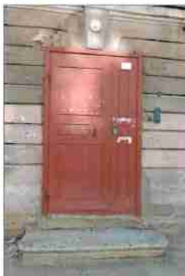
3. Фрагмент восточного фасада.
