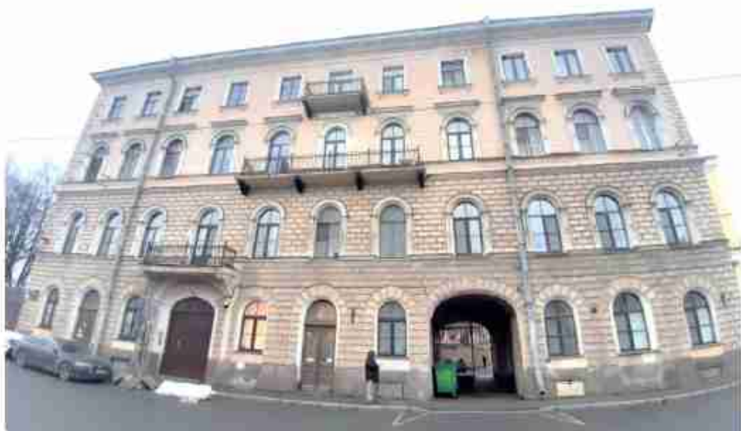
43. «Жилой дом» (в составе выявленного объекта культурного наследия «Комплекс жилых домов Тарасовых») (наб. реки Фонтанки, д. 116, лит. А). Лицевой фасад по наб. реки Фонтанки. Штиглиц М.С. 26.12.2024.
