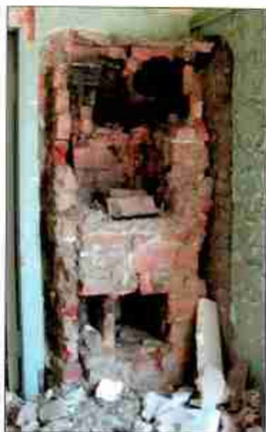
23. Печь (помещение без номера, площадью 16,2 кв. м, по дворному фасаду). Четвертый этаж.
