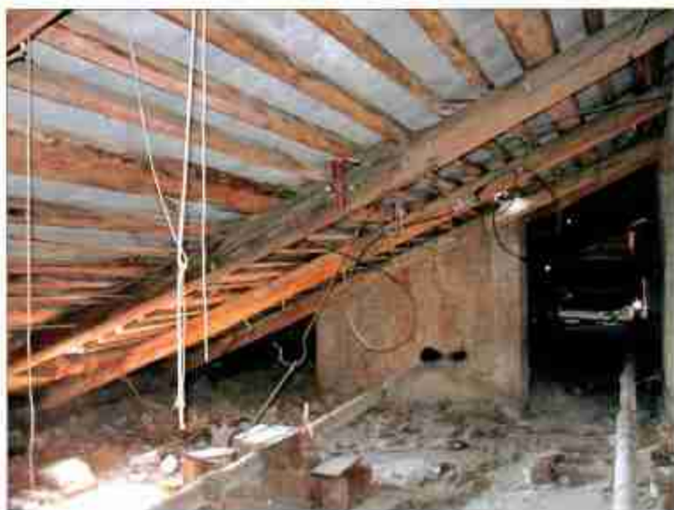
9. Чердак. Стропильная система.
