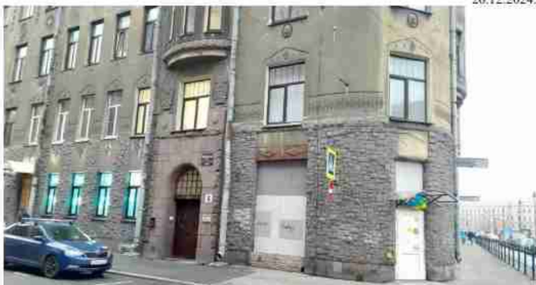
10. «Дом В.В. Васильевой» (Подольская ул., д. 1-3-5, лит. А). Лицевой фасад (фрагмент). Фото мест установки оборудования и кабельных трасс. Штиглиц М.С. 26.12.2024.
