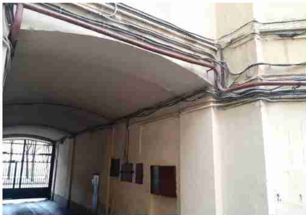
31. «Доходный дом» (в составе «Особняк и доходный дом К.Л. Миллера») (Якубовича ул., д. 2, лит. А). Арочный проезд. Фото мест установки оборудования и кабельных трасс. Штиглиц М.С. 26.12.2024.
