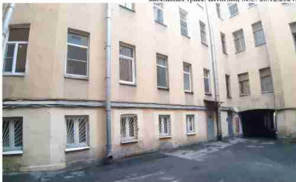
36. «Доходный дом» (в составе «Доходные дома Н.И. Львовой (А.Д. Сивкова)) (Угловой пер., д. 9, лит. А). Дворовые фасады. Фото мест установки оборудования и кабельных трасс. Штиглиц М.С. 26.12.2024.
