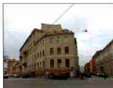
Фото 3. Южный фасад со стороны пр. Римского-Корсакова.
