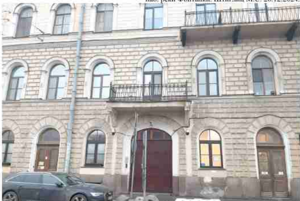
44. «Жилой дом» (в составе выявленного объекта культурного наследия «Комплекс жилых домов Тарасовых») (наб. реки Фонтанки, д. 116, лит. А). Лицевой фасад (фрагмент). Фото мест установки оборудования и кабельных трасс. Штиглиц М.С. 26.12.2024.
