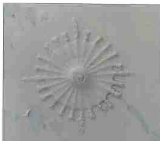
27. Оформление потолка (помещение № 1). Пятый этаж. Фрагмент.
