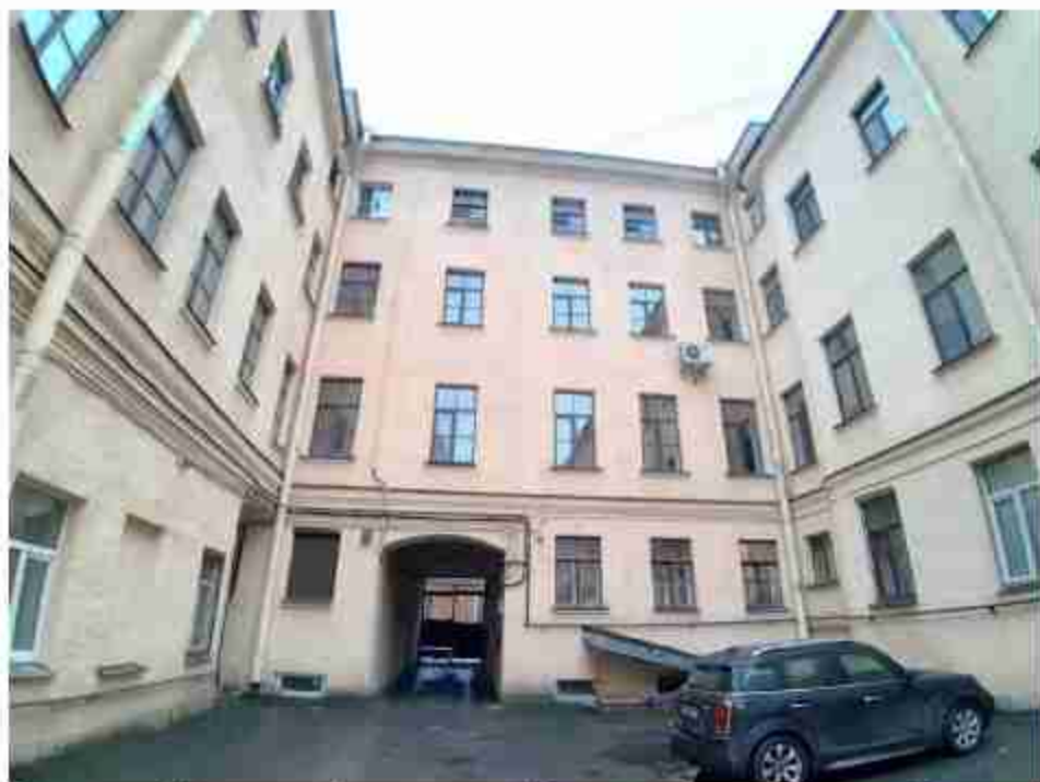
5. «Дома купца Чельшева» (Галерная ул., д. 25, лит. А). Дворовые фасады. Фото мест установки оборудования и кабельных трасс. Штиглиц М.С. 26.12.2024.
