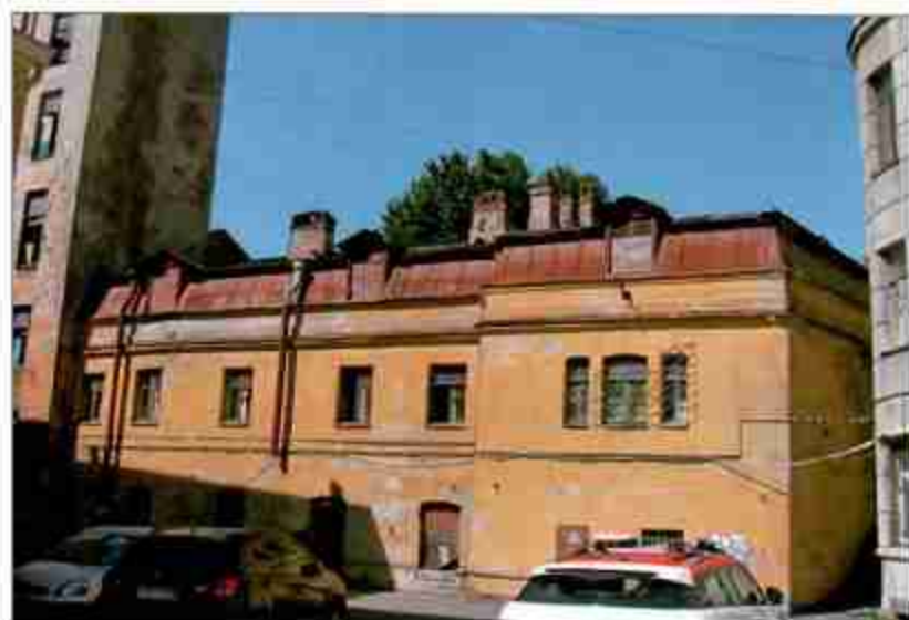
3. «Дом и служба». Дворовые фасады. Вид с юго-востока.
