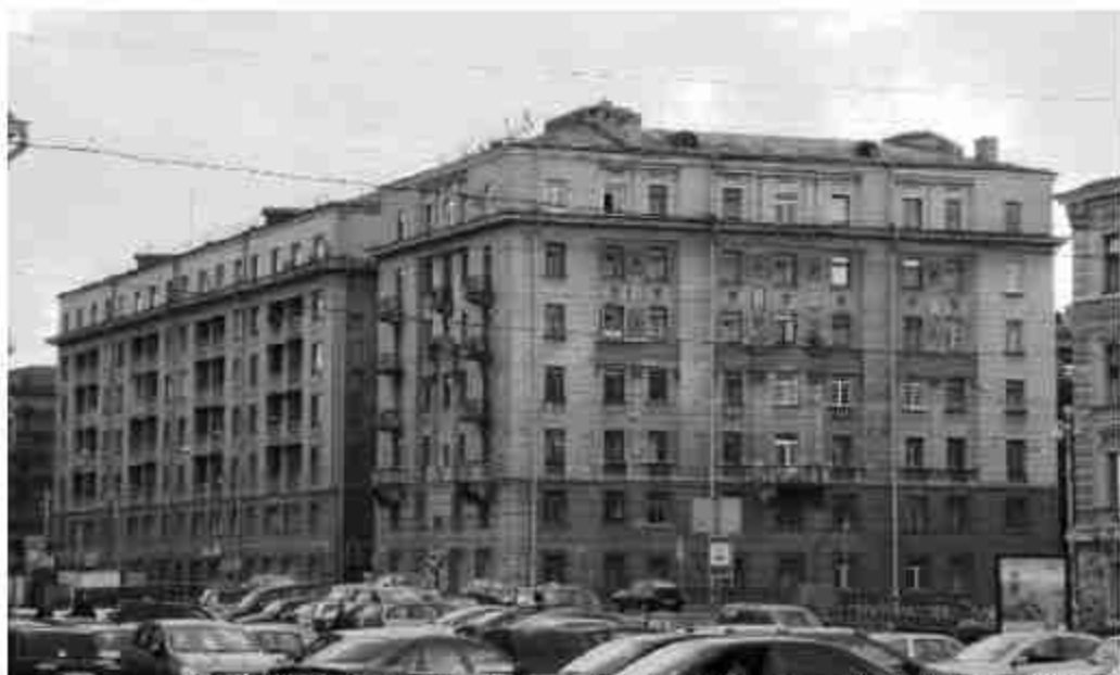
43. «Жилой дом работников Союзверфи» (Декабристов ул., д. 29, лит. Б). Фото 2007 (31).
