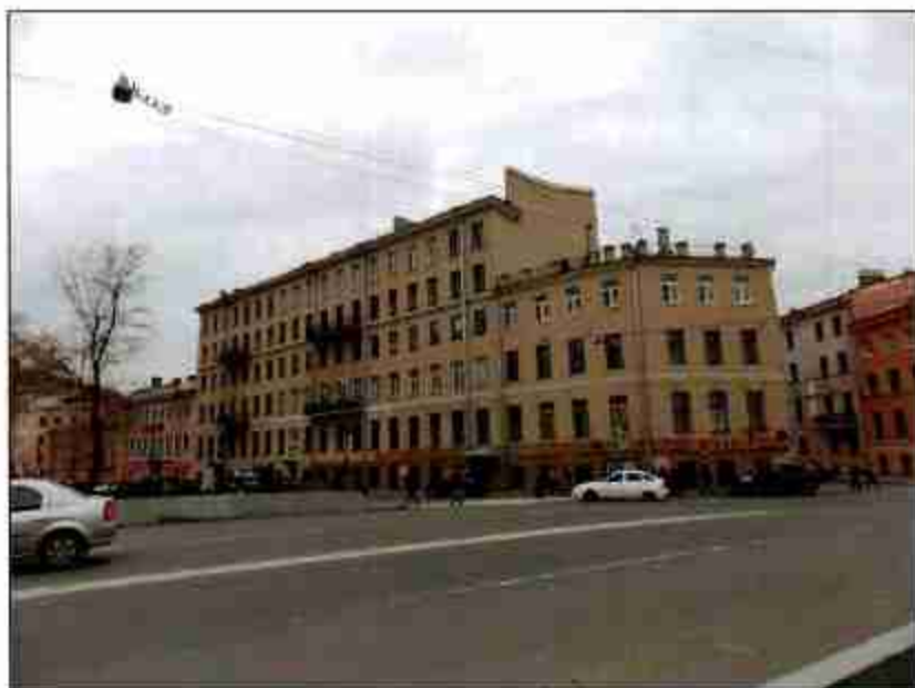
Фото 1. Юго-западный фасад со стороны канала Грибоедова.
