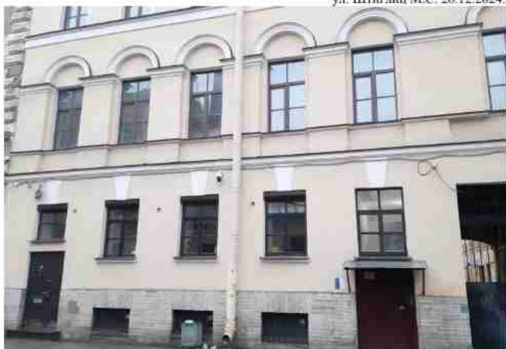
2. «Дома купца Чельшева» (Галерная ул., д. 25, лит. А). Лицевой фасад (фрагмент). Фото мест установки оборудования и кабельных трасс. Штиглиц М.С. 26.12.2024.
