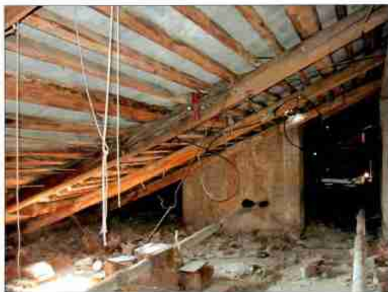
9. Чердак. Стропильная система.
