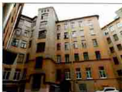
Фото 15. Восточный дворовый фасад.
