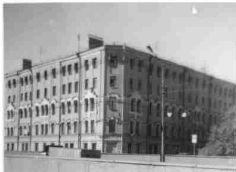
45. «Доходный дом» (в составе «Доходные дома Н.И. Львовой (А.Д. Снякова)») (Угловой пер., д. 9, лит. А). Фото 1999 (21).
