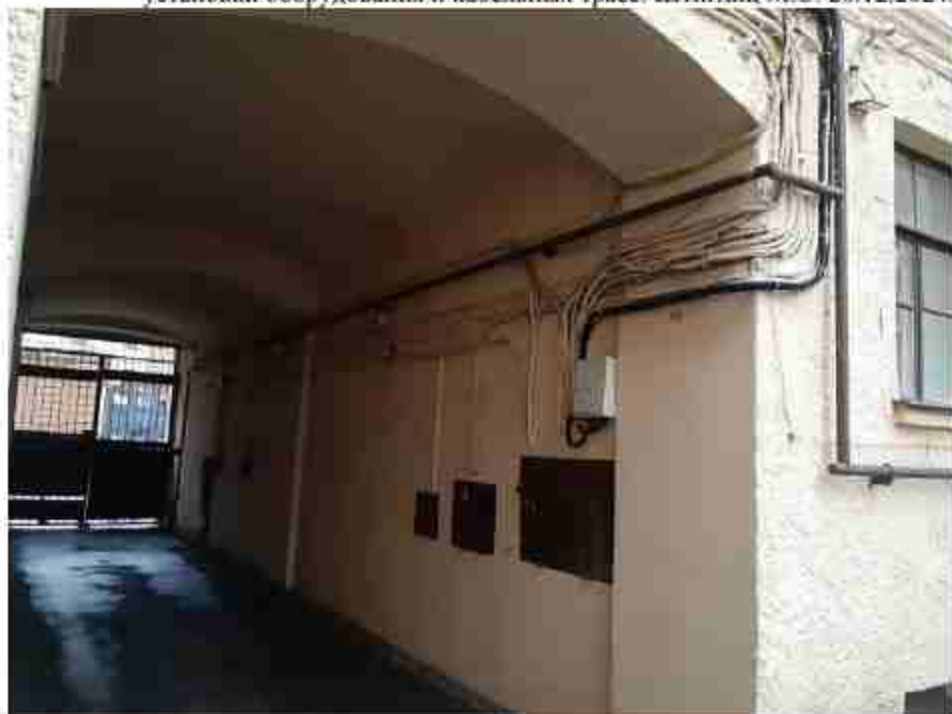
6. «Дома купца Чельшева» (Галерная ул., д. 25, лит. А). Арочный проезд. Фото мест установки оборудования и кабельных трасс. Штиглиц М.С. 26.12.2024.
