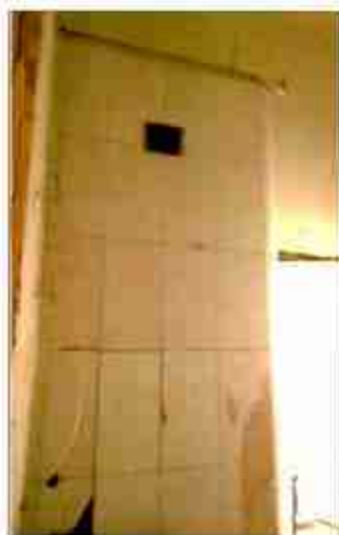
19. Печь (коридор, помещение № 10). Третий этаж. Фрагмент.
