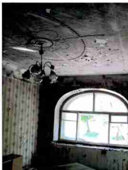
18. Помещение без номера, площадью 18,9 кв.м, по лицевому фасаду. Второй этаж.
