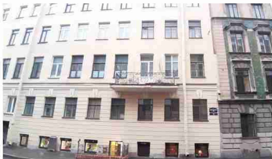
13. «Дом И. Вальха, в котором в 1816-1818 годах жил А.С. Грибоедов» (Средняя Подъячская ул., д. 15, лит. А). Лицевой фасад (фрагмент). Фото мест установки оборудования и кабельных трасс. Штиглиц М.С. 26.12.2024.
