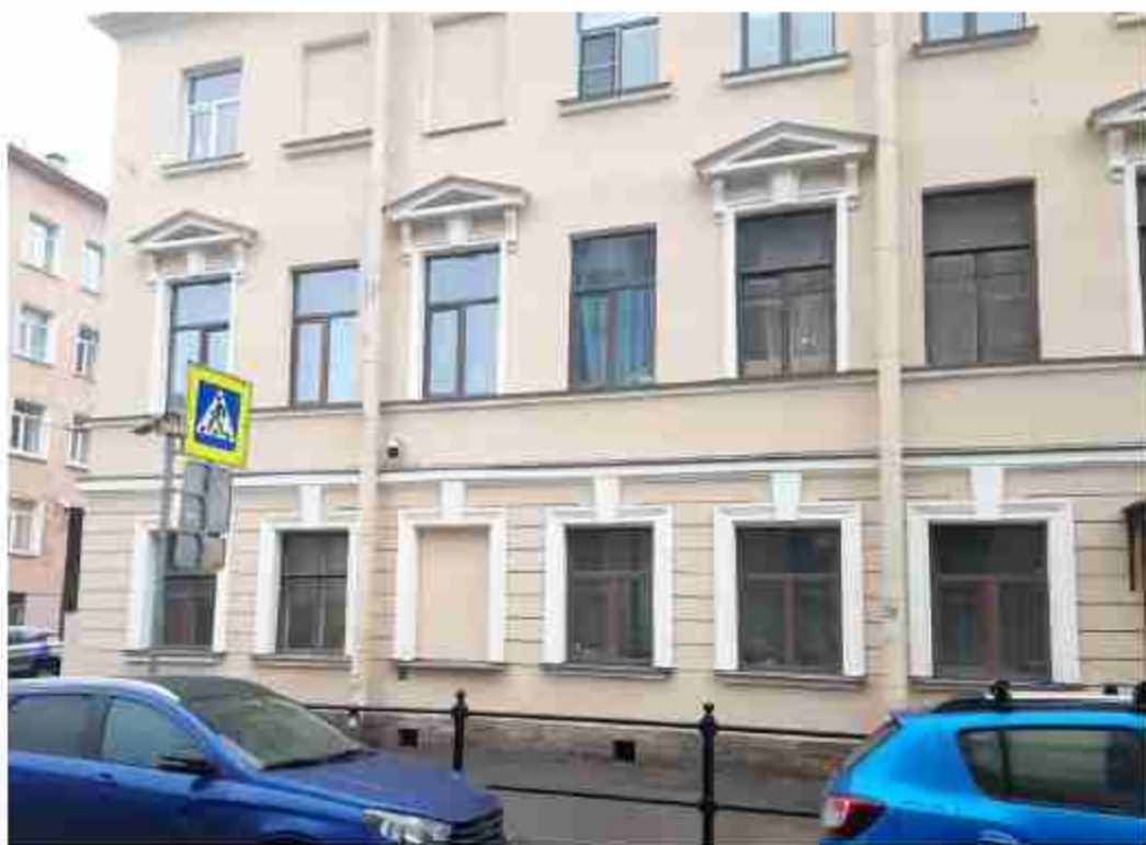
21. «Жилой дом» (Пасторова ул., д. 7, лит. А). Лицевой фасад (фрагмент). Фото мест установки оборудования и кабельных трасс. Штиглиц М.С. 26.12.2024.
