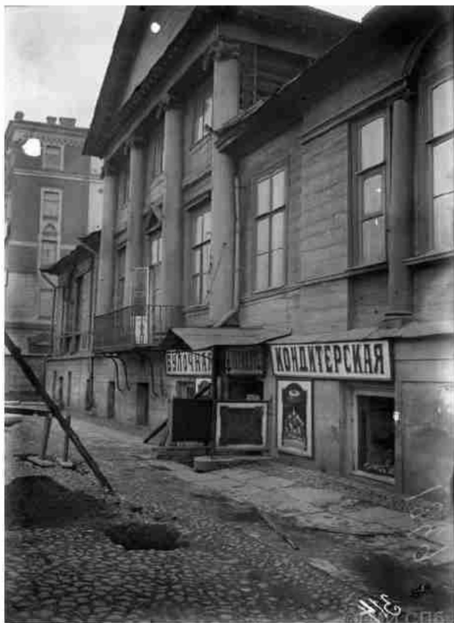
3. «Дом В.В. Васильевой» (Подольская ул., д. 1-3-5, лит. А). Деревянный дом, ранее существовавший на этом месте С сайта goxkatalog.ru .
