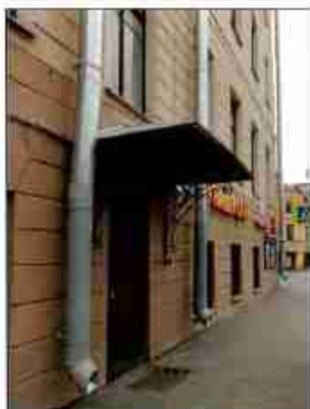
Фото 10. Вход со стороны юго-западного фасада (пом. 4-П).
