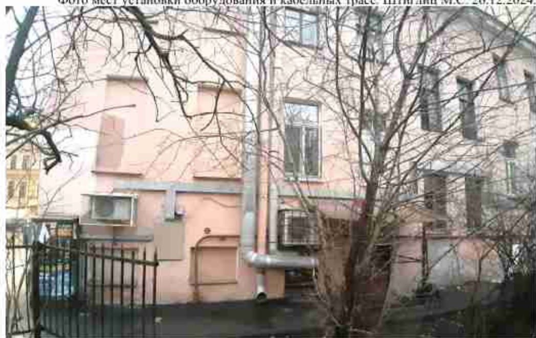
42. «Дом Панфилова» (Лермонтовский пр., д. 27, лит. А). Дворовые фасады. Фото мест установки оборудования и кабельных трасс. Штиглиц М.С. 26.12.2024.
