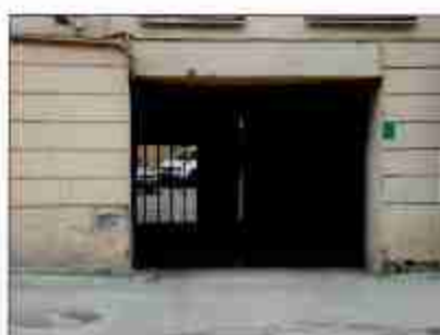
Фото 7. Воротный проезд восточного фасада.
