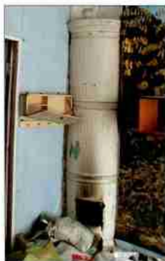
36. Печь угловая (квартира № 60). Второй этаж.
