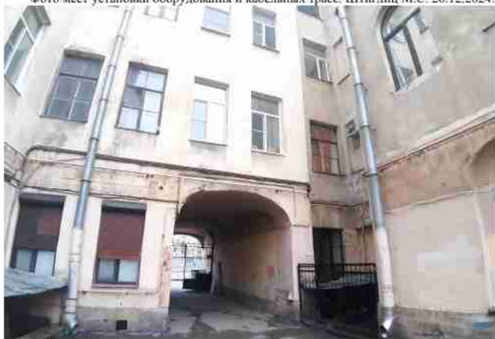
46. «Жилой дом» (в составе выявленного объекта культурного наследия «Комплекс жилых домов Тарасовых») (наб. реки Фонтанки, д. 116, лит. А). Дворовые фасады. Фото мест установки оборудования и кабельных трасс. Штиглиц М.С. 26.12.2024.
