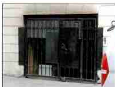
Фото 6. Воротный проезд юго-западного фасада
