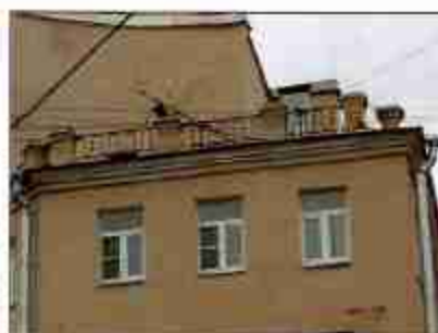
Фото 5. Фрагмент южного фасада.
