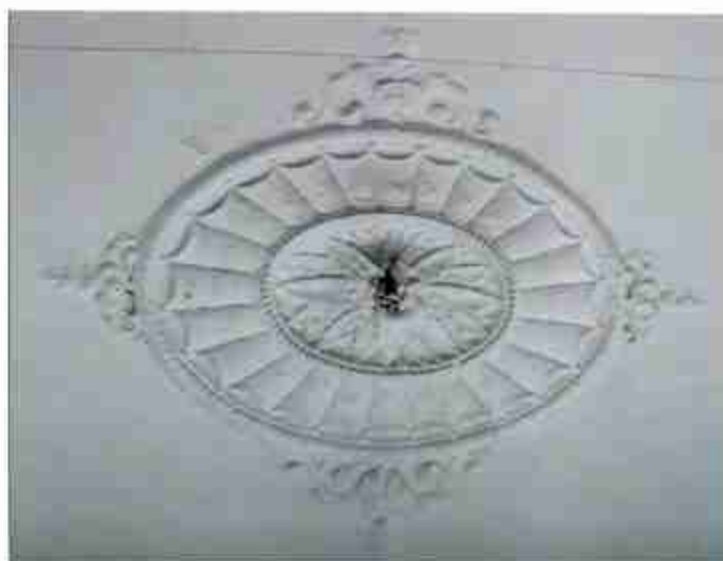
28. Оформление потолка арки (помещение № 1). Пятый этаж.
