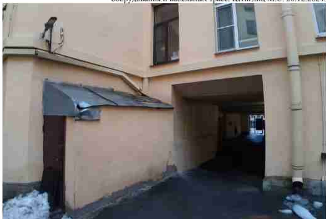
18. «Дом И. Вальха, в котором в 1816-1818 годах жил А.С. Грибоедов» (Средняя Подъячская ул., д. 15, лит. А). Арочный проезд. Фото мест установки оборудования и кабельных трасс. Штиглиц М.С. 26.12.2024.
