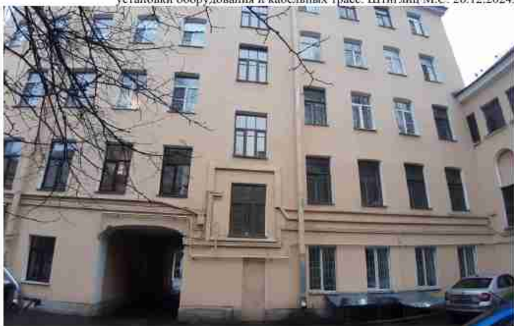
22. «Жилой дом» (Пасторова ул., д. 7, лит. А). Дворовые фасады. Фото мест установки оборудования и кабельных трасс. Штиглиц М.С. 26.12.2024.
