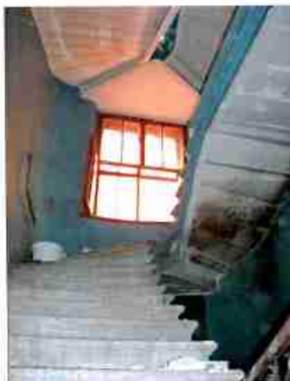
12. Нарядная лестница в уровне второго этажа.
