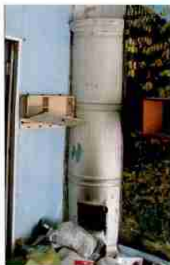
36. Печь угловая (квартира № 60). Второй этаж.
