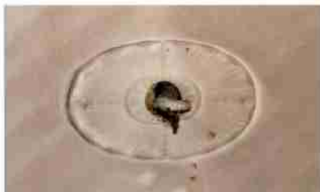
17. Оформление потолка (комната № 14). Второй этаж.
