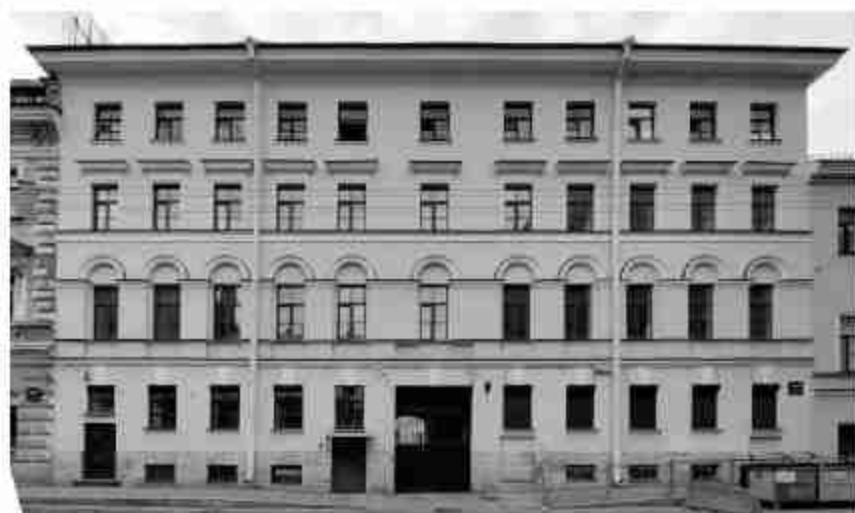
2. «Дома купца Челышева» (Галерная ул., д. 25, лит. А). Фото 2009 (31).
