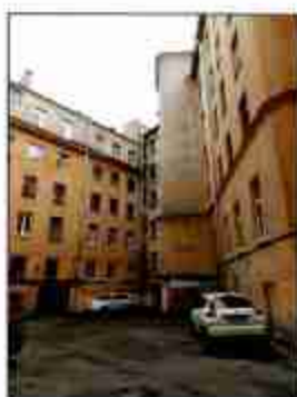
Фото 16. Западный дворовый фасад.
