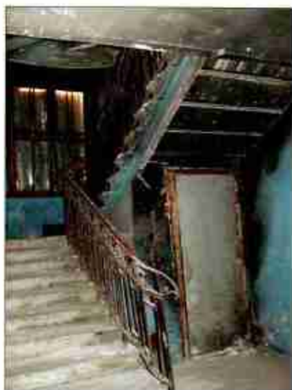
11. Парадная лестница в уровне первого этажа.
