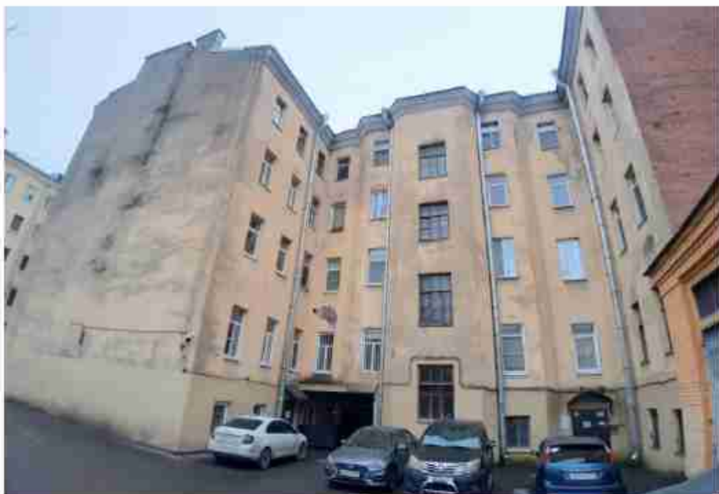
33. «Доходный дом» (в составе «Доходные дома Н.И. Львовой (А.Д. Сивкова)) (Угловой пер., д. 9, лит. А). Дворовые фасады. Фото мест установки оборудования и кабельных трасс. Штиглиц М.С. 26.12.2024.
