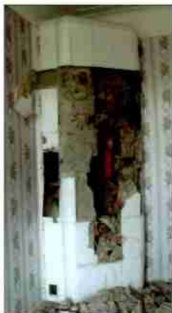
30. Печь усовая (помещение № 3, площадью 15,7 кв. м, вдоль зеленого фасада). Пятый этаж.
