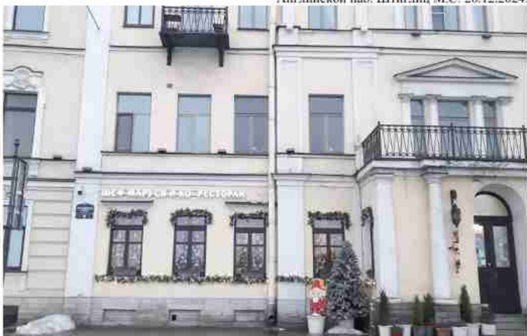
4. «Дома купца Чельшева» (Галерная ул., д. 25, лит. А). Лицевой фасад (фрагмент). Фото мест установки оборудования и кабельных трасс. Штиглиц М.С. 26.12.2024.
