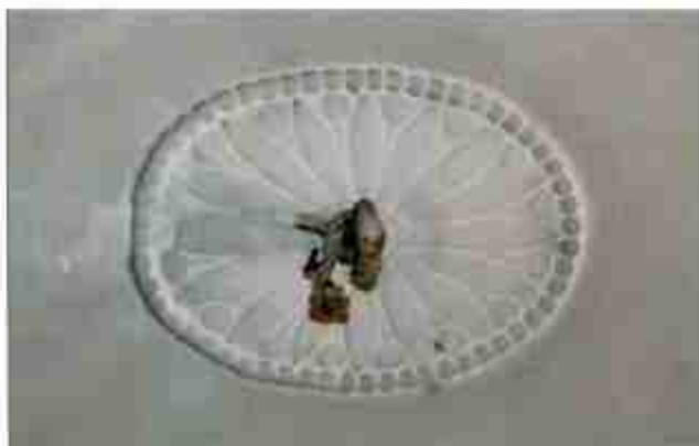
16. Оформление потолка (квартира №1, комната №2). Второй этаж.
