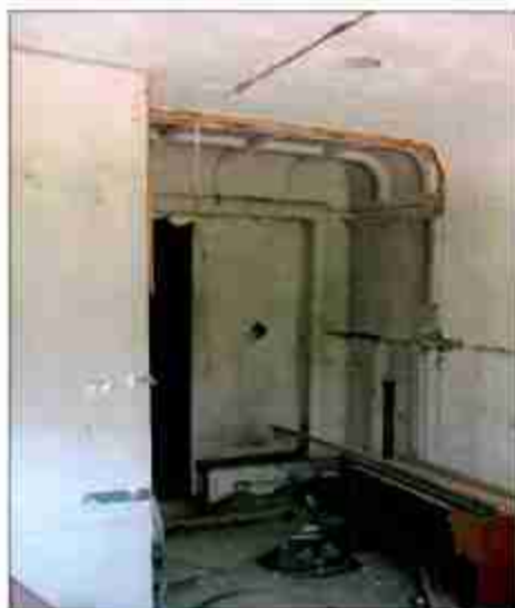
15. Тамбур (помещение 12-Н). Второй этаж.
