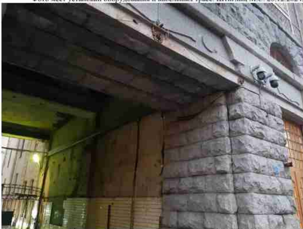
26. «Дом и службы» (в составе «Дом и особняк полковника Ф.Г. Козлянинова с садом, палисадником, оградой») (Писарева ул., д. 10, лит. В). Арочный проезд. Фото мест установки оборудования и кабельных трасс. Штиглиц М.С. 26.12.2024.
