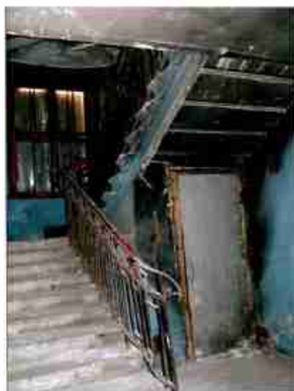
11. Нарядная лестница в уровне первого этажа.
