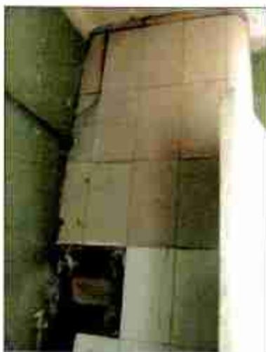
24. Печь (коридор, помещение без номера). Четвертый этаж.
