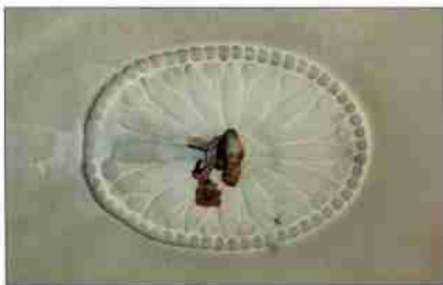
16. Оформление потолка (квартира №1, комната №2), Второй этаж.
