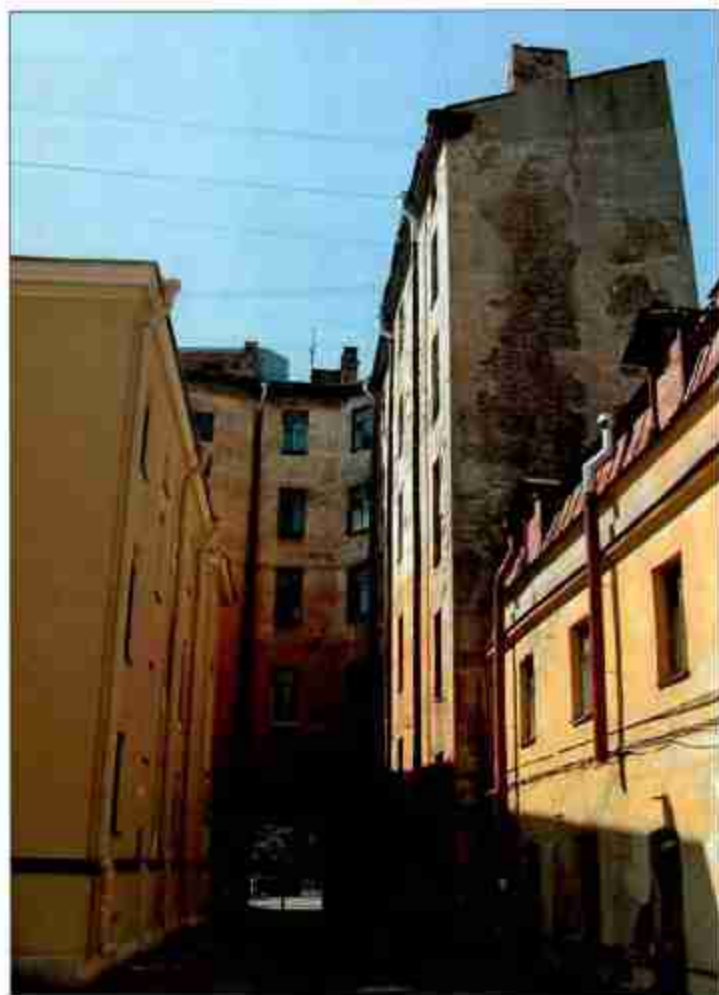
2. «Дом и службы». Дворовые фасады. Вид с востока.
