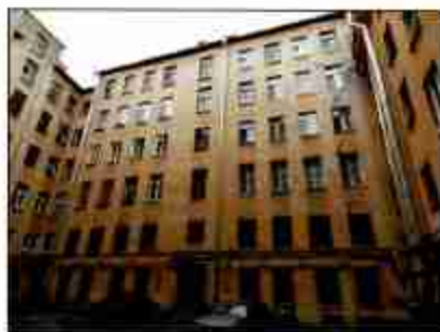
Фото 14. Южный дворовый фасад
