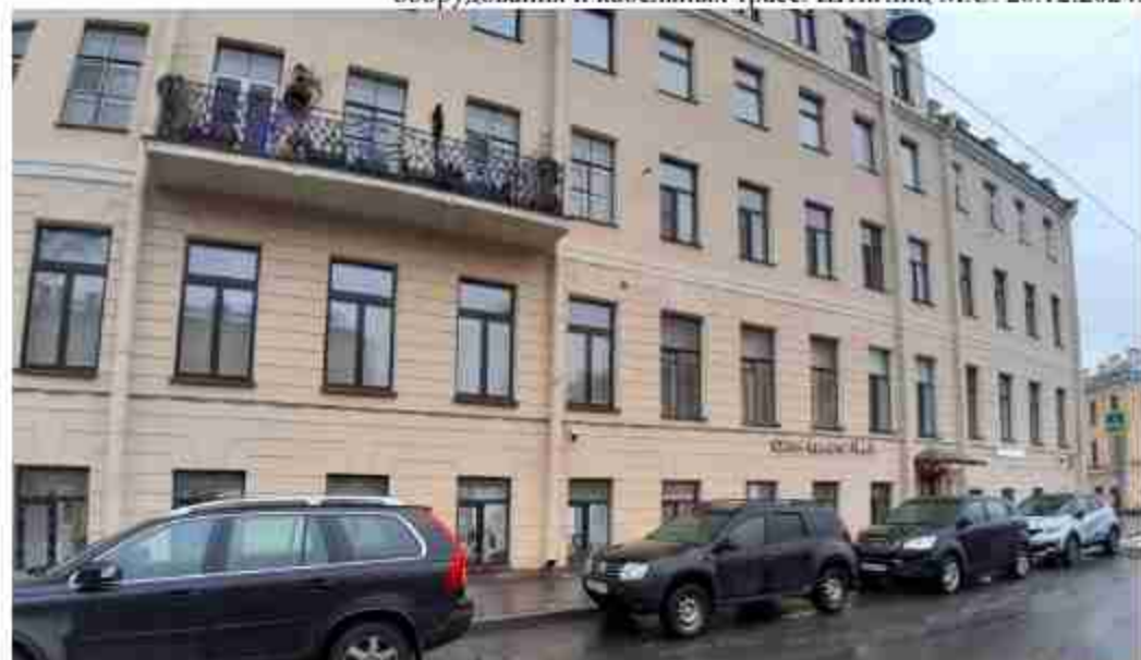
14. «Дом И. Вальха, в котором в 1816-1818 годах жил А.С. Грибоедов» (Средняя Подъячская ул., д. 15, лит. А). Лицевой фасад (фрагмент). Фото мест установки оборудования и кабельных трасс. Штиглиц М.С. 26.12.2024.
