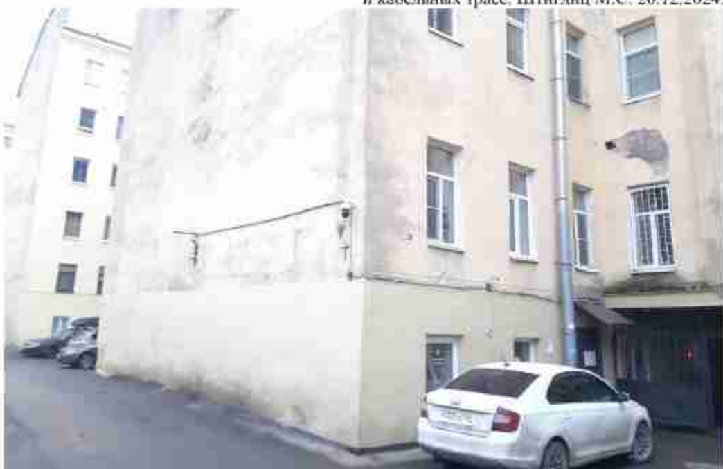
34. «Доходный дом» (в составе «Доходные дома Н.И. Львовой (А.Д. Сивкова)) (Угловой пер., д. 9, лит. А). Дворовые фасады. Фото мест установки оборудования и кабельных трасс. Штиглиц М.С. 26.12.2024.
