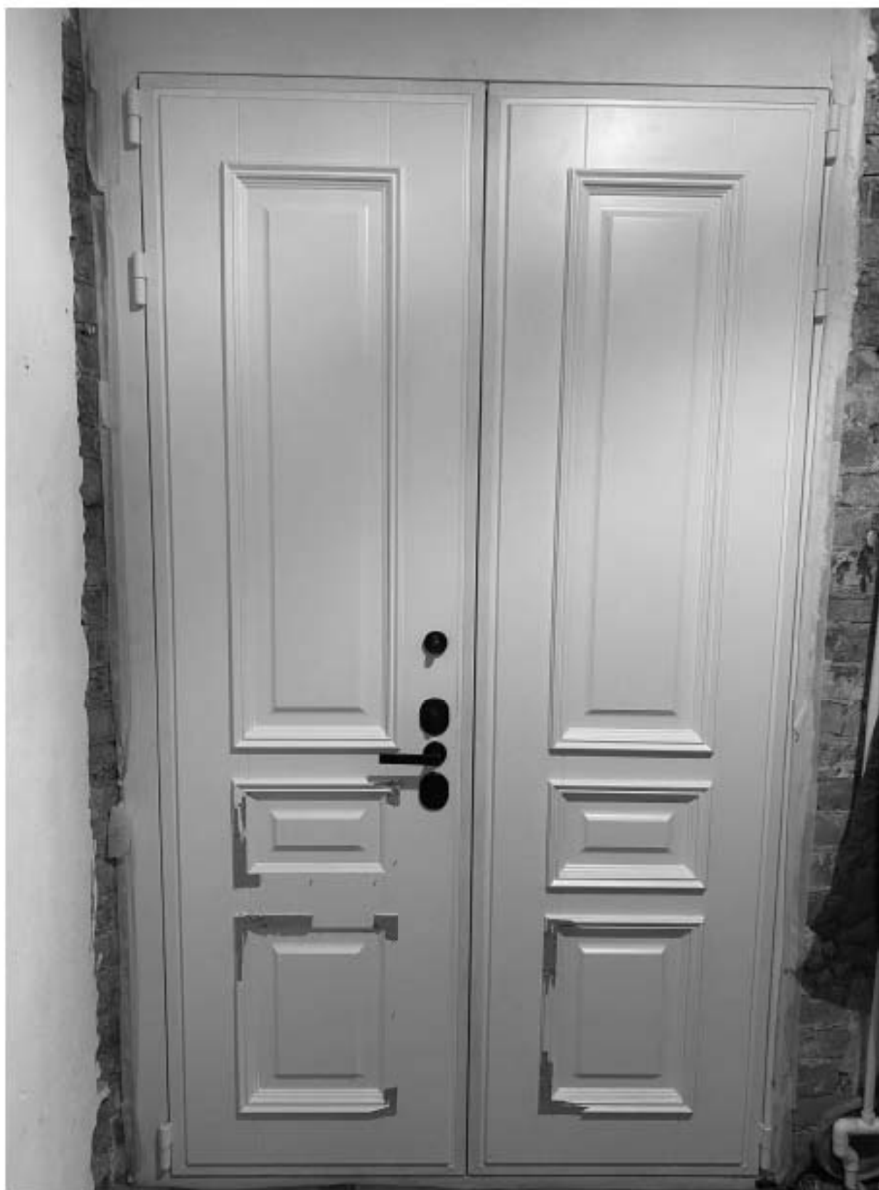
4. Вид на входную дверь в квартире №56;
