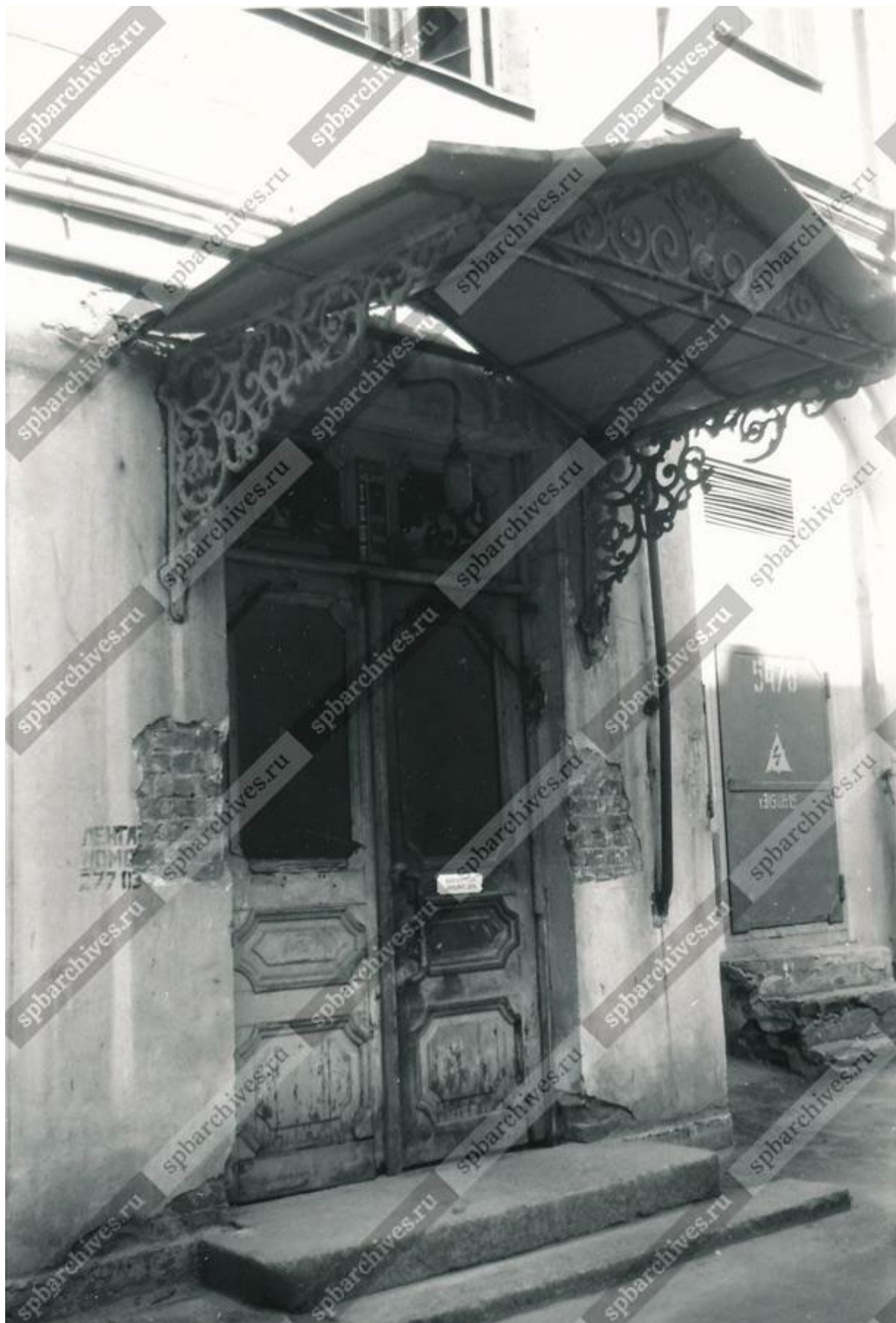
15. Вид навеса на ажурных кронштейнах дома № 11 по улице Миллионной со стороны двора. Фото 1993 г.
