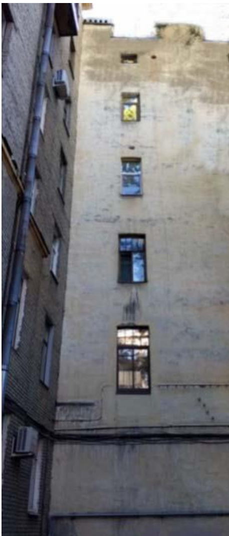
63. «Дом Санкт-Петербургского товарищества для устройства постоянных квартир», Большая Посадская ул., д. 1/10, лит. А. Дворовый фасад. Фрагмент. Фото 10.02.2025г.
