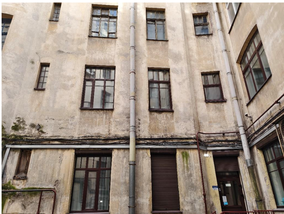
49. «Дом Санкт-Петербургского товарищества для устройства постоянных квартир», Большая Посадская ул., д. 1/10, лит. А. Дворовый фасад. Фрагмент. Фото 10.02.2025г.
