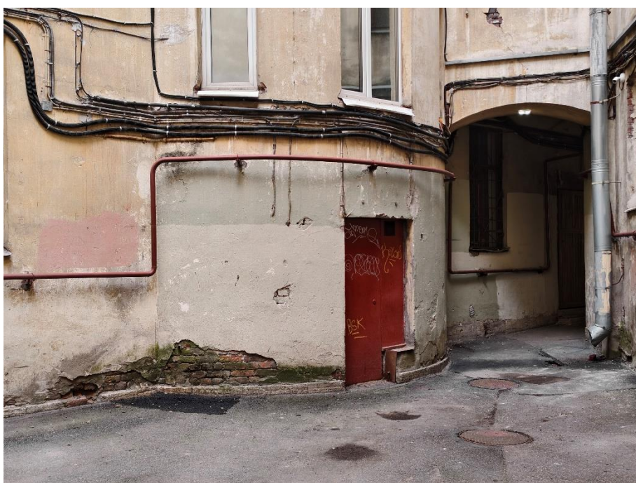
56. «Дом Санкт-Петербургского товарищества для устройства постоянных квартир», Большая Посадская ул., д. 1/10, лит. А. Дворовый фасад. Фрагмент. Фото 10.02.2025г.
