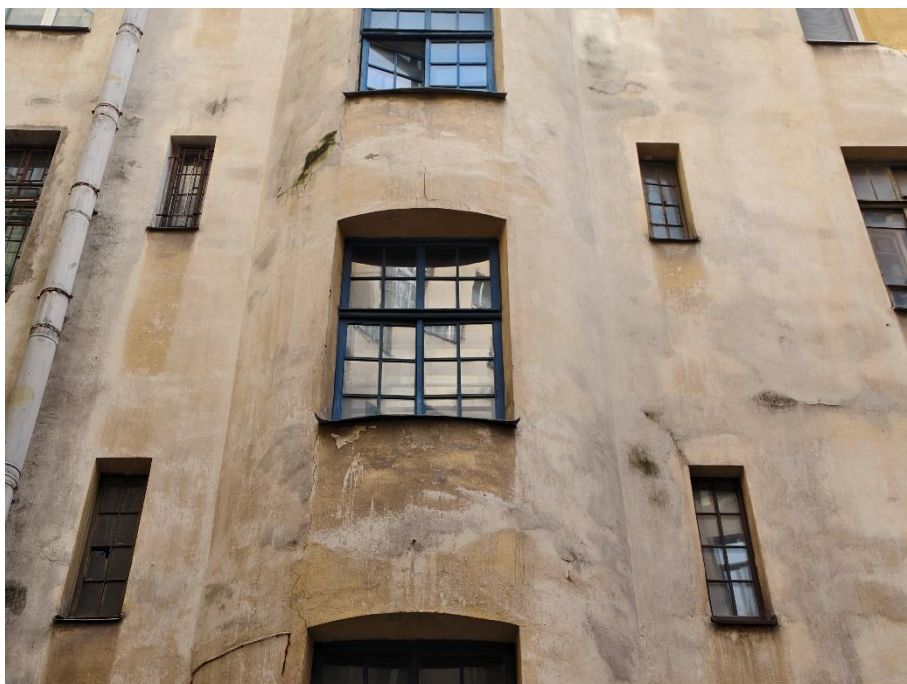
51. «Дом Санкт-Петербургского товарищества для устройства постоянных квартир», Большая Посадская ул., д. 1/10, лит. А. Дворовый фасад. Фрагмент. Фото 10.02.2025г.
