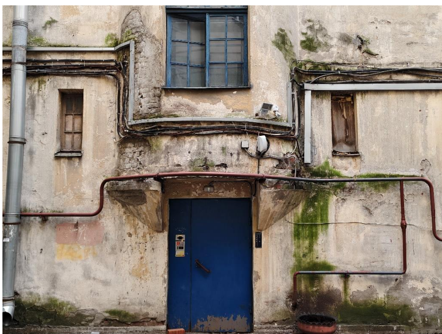
52. «Дом Санкт-Петербургского товарищества для устройства постоянных квартир», Большая Посадская ул., д. 1/10, лит. А. Дворовый фасад. Фрагмент. Фото 10.02.2025г.
