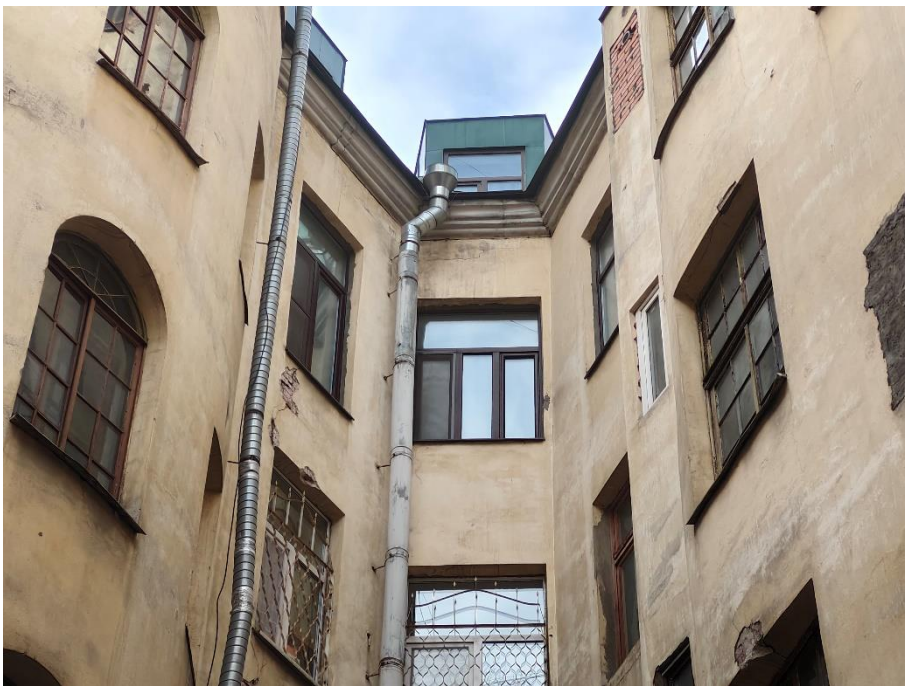
60. «Дом Санкт-Петербургского товарищества для устройства постоянных квартир», Большая Посадская ул., д. 1/10, лит. А. Дворовый фасад. Фрагмент. Фото 10.02.2025г.
