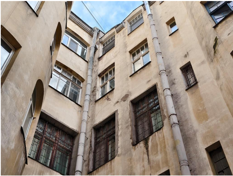
53. «Дом Санкт-Петербургского товарищества для устройства постоянных квартир», Большая Посадская ул., д. 1/10, лит. А. Дворовый фасад. Фрагмент. Фото 10.02.2025г.
