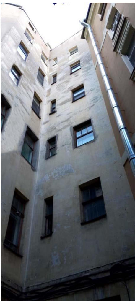
62. «Дом Санкт-Петербургского товарищества для устройства постоянных квартир», Большая Посадская ул., д. 1/10, лит. А. Дворовый фасад. Фрагмент. Фото 10.02.2025г.
