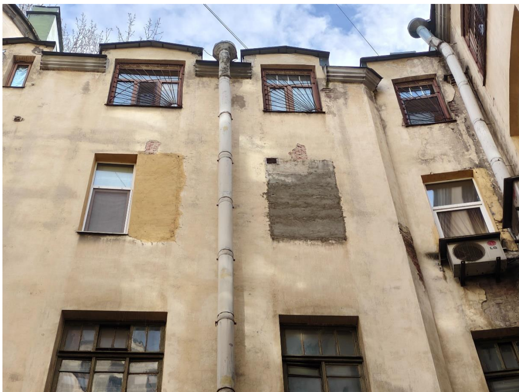
48. «Дом Санкт-Петербургского товарищества для устройства постоянных квартир», Большая Посадская ул., д. 1/10, лит. А. Дворовый фасад. Фрагмент. Фото 10.02.2025г.
