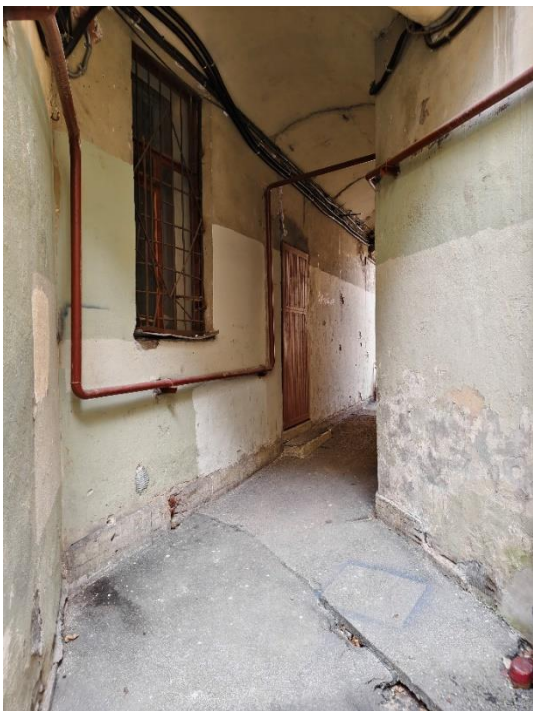
61. «Дом Санкт-Петербургского товарищества для устройства постоянных квартир», Большая Посадская ул., д. 1/10, лит. А. Дворовый фасад. Фрагмент. Фото 10.02.2025г.
