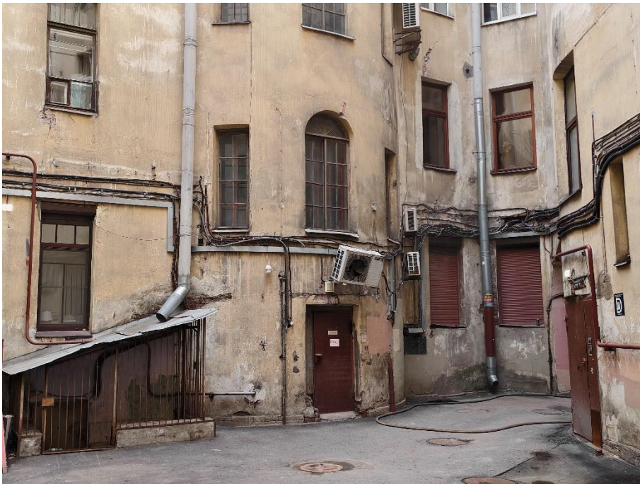
59. «Дом Санкт-Петербургского товарищества для устройства постоянных квартир», Большая Посадская ул., д. 1/10, лит. А. Дворовый фасад. Фрагмент. Фото 10.02.2025г.
