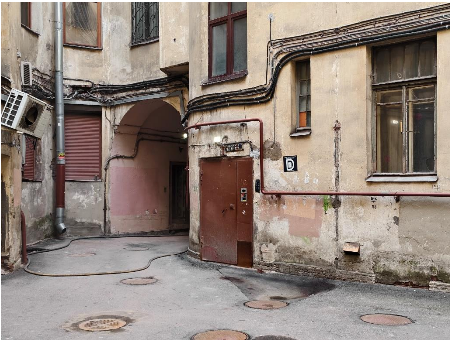
57. «Дом Санкт-Петербургского товарищества для устройства постоянных квартир», Большая Посадская ул., д. 1/10, лит. А. Дворовый фасад. Фрагмент. Фото 10.02.2025г.
