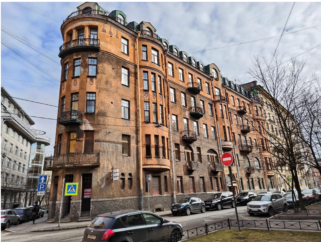
3. «Дом Санкт-Петербургского товарищества для устройства постоянных квартир», Большая Посадская ул., д. 1/10, лит. А. Юго-западный фасад. Общий вид. Фото 10.02.2025г.
