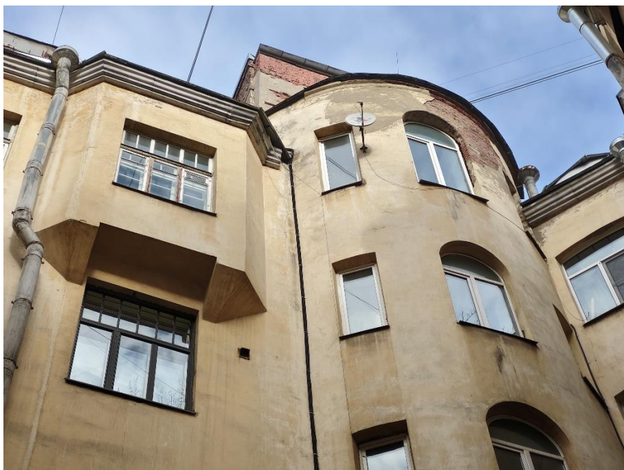
55. «Дом Санкт-Петербургского товарищества для устройства постоянных квартир», Большая Посадская ул., д. 1/10, лит. А. Дворовый фасад. Фрагмент. Фото 10.02.2025г.
