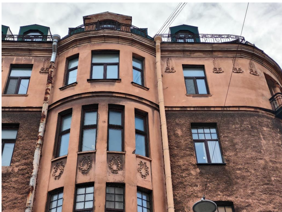
29. «Дом Санкт-Петербургского товарищества для устройства постоянных квартир», Большая Посадская ул., д. 1/10, лит. А. Северо-западный фасад. Фрагмент. Фото 10.02.2025г.
