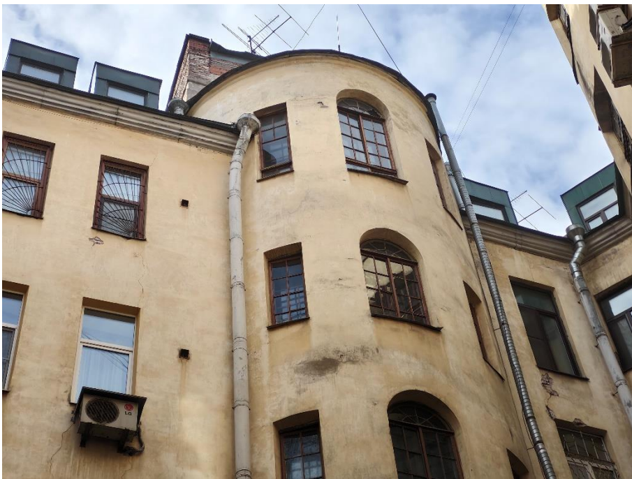
58. «Дом Санкт-Петербургского товарищества для устройства постоянных квартир», Большая Посадская ул., д. 1/10, лит. А. Дворовый фасад. Фрагмент. Фото 10.02.2025г.
