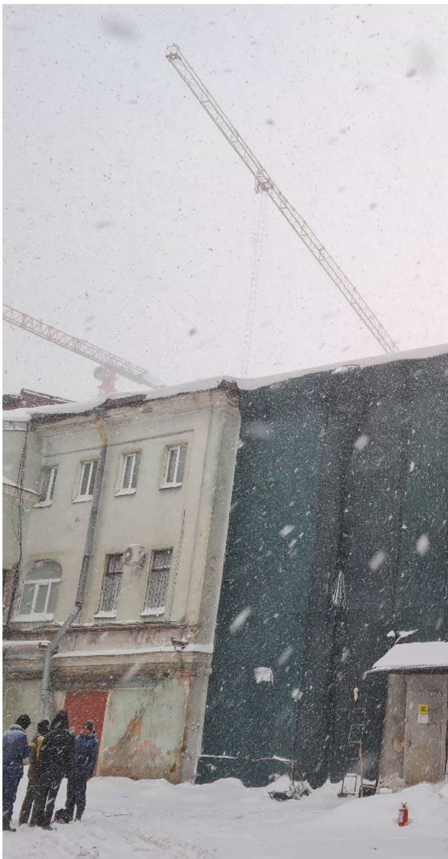
Фото 8. Фрагмент дворового (юго-западного) фасада. Примыкание к соседнему корпусу по Кожевенной линии. В настоящее время, на фасады здания установлены защитные укрывные сетки.
