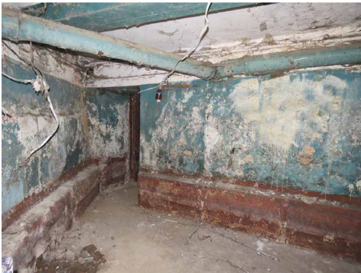
Фото 2. Подвал. Помещение 1-Н. Общий вид.
