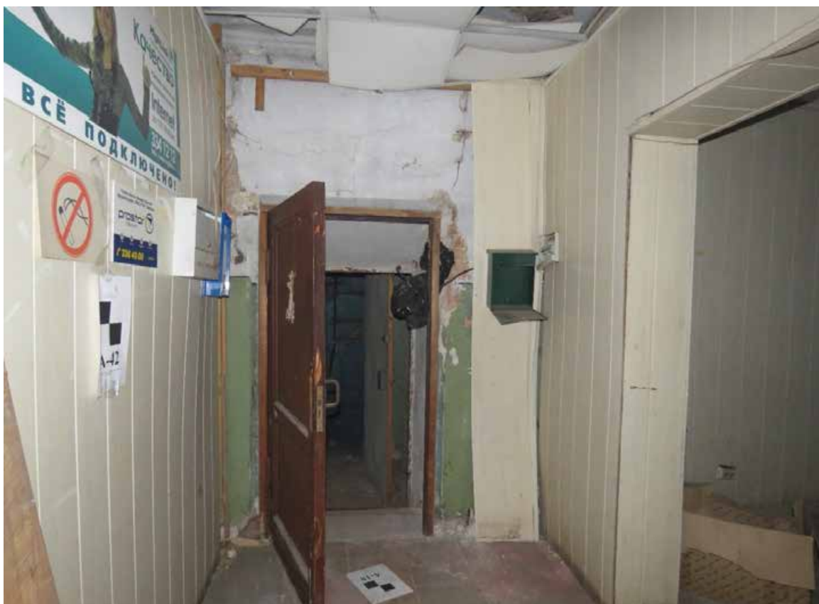
Фото 8. 1 этаж. Помещение 1-Н (№ 4). Вид на свод и входную дверь пом. № 2.
