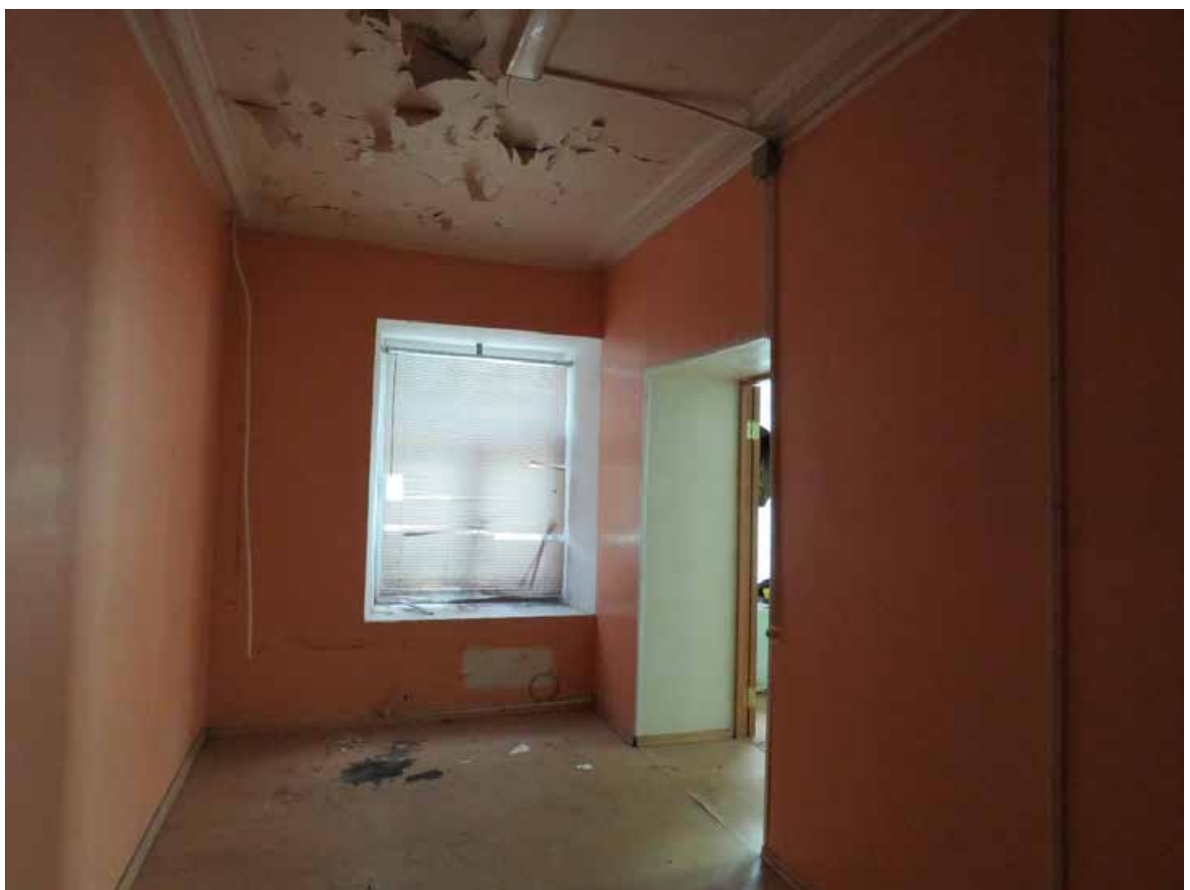
Фото 14. 1 этаж. Помещение 1-Н (№ 13). Общий вид.
