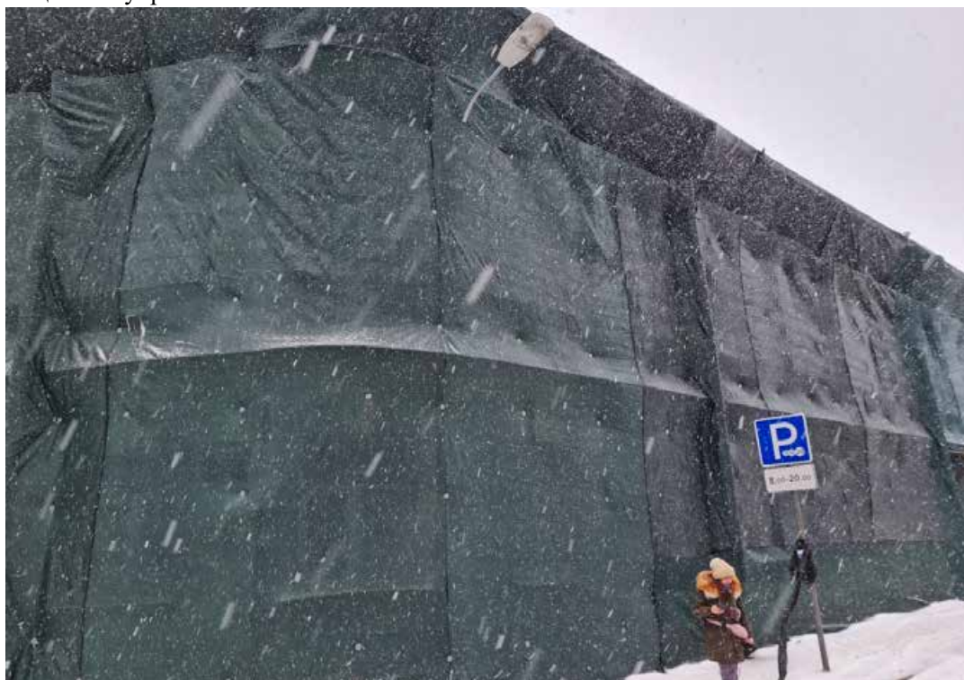
Фото 2. Общий вид вдоль Масляного канала. В настоящее время, на фасады здания установлены защитные укрывные сетки.
