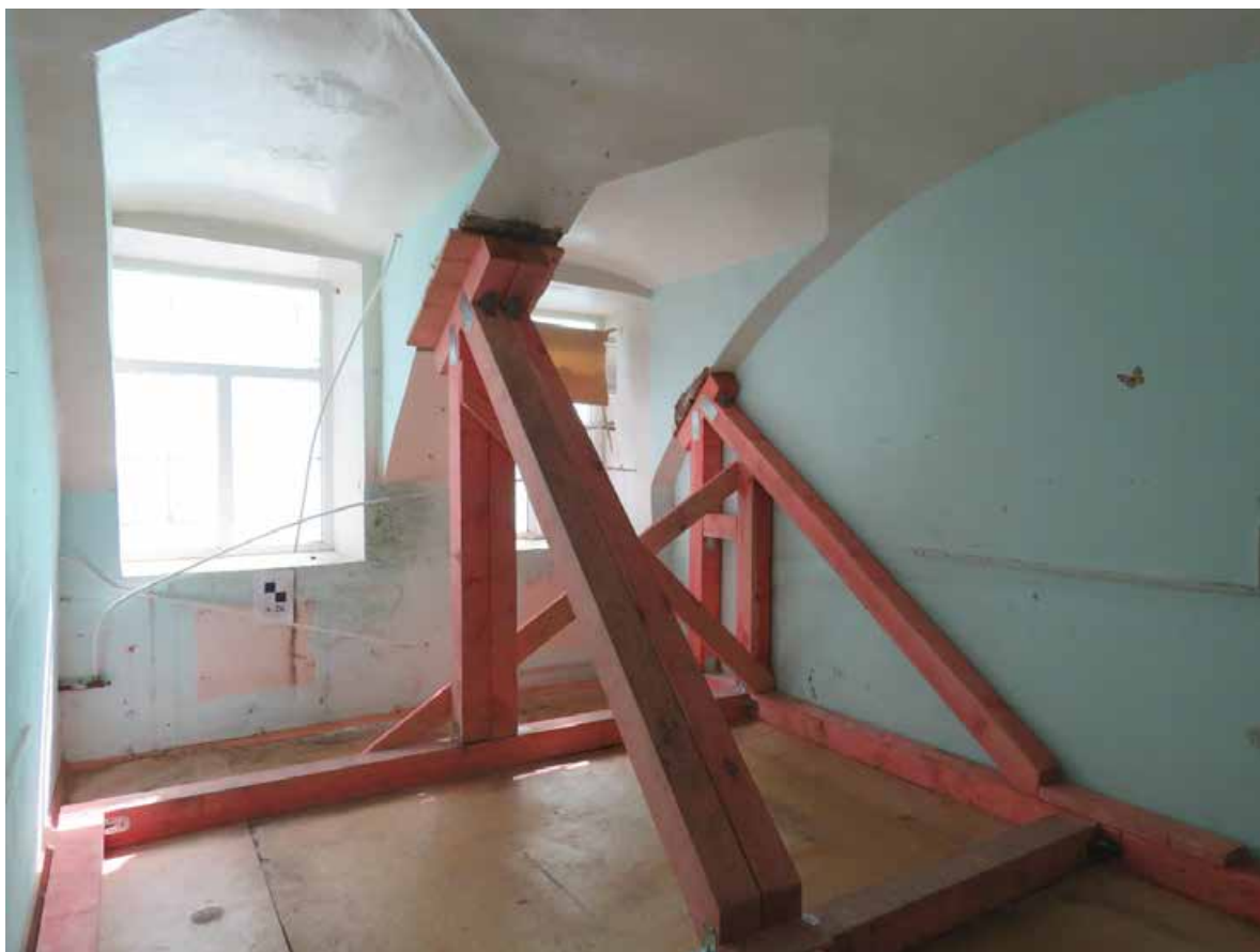
Фото 17. 1 этаж. Помещение 1-Н (№ 25). Общий вид.
