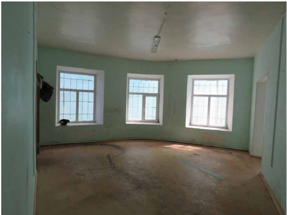
Фото 13. 1 этаж. Помещение 1-Н (№ 14). Общий вид.
