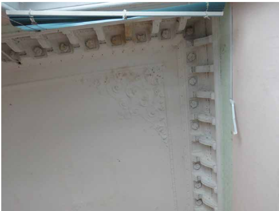
Фото 31. 2 этаж. Помещение 1-Н (№ 56). Фрагмент плафона. Потолочный декор.
