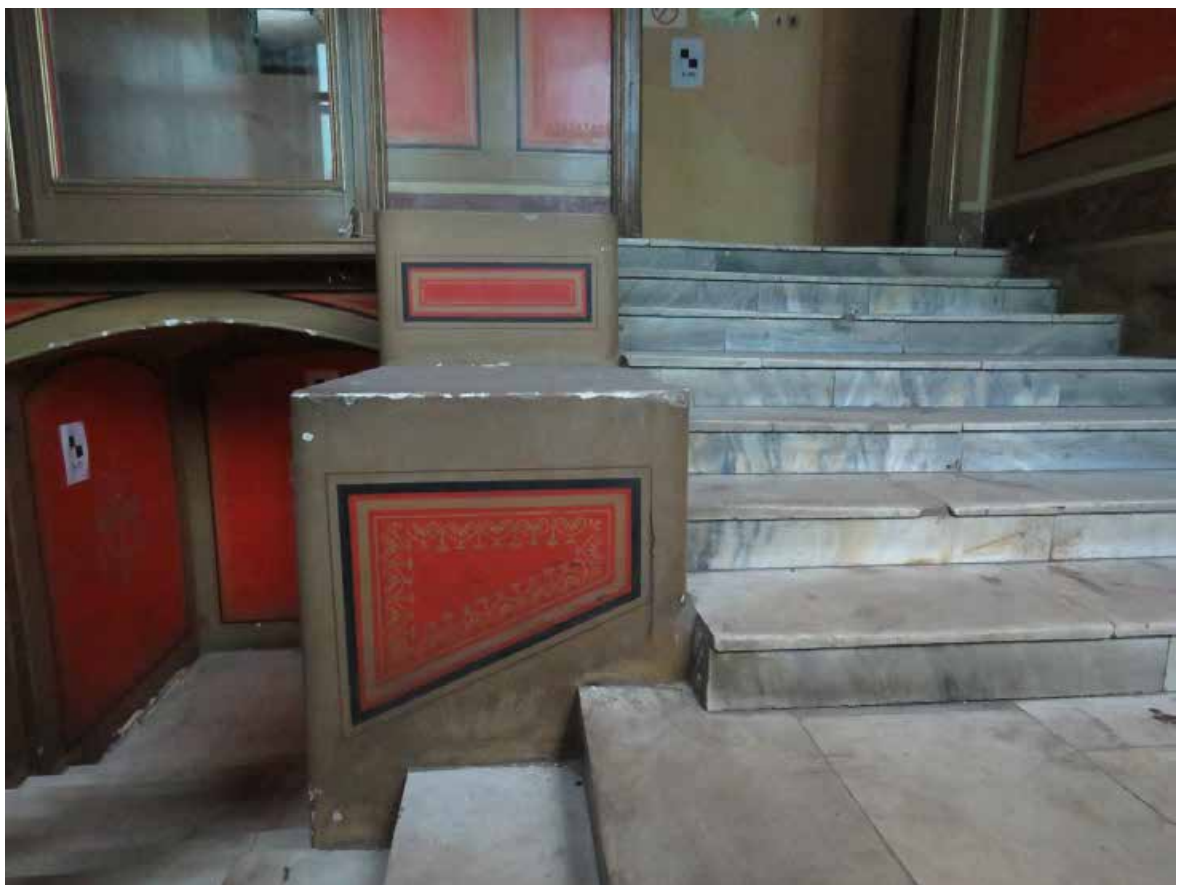
Фото 22. Лестница. Помещение 1-Н (№ 62). Общий вид.
