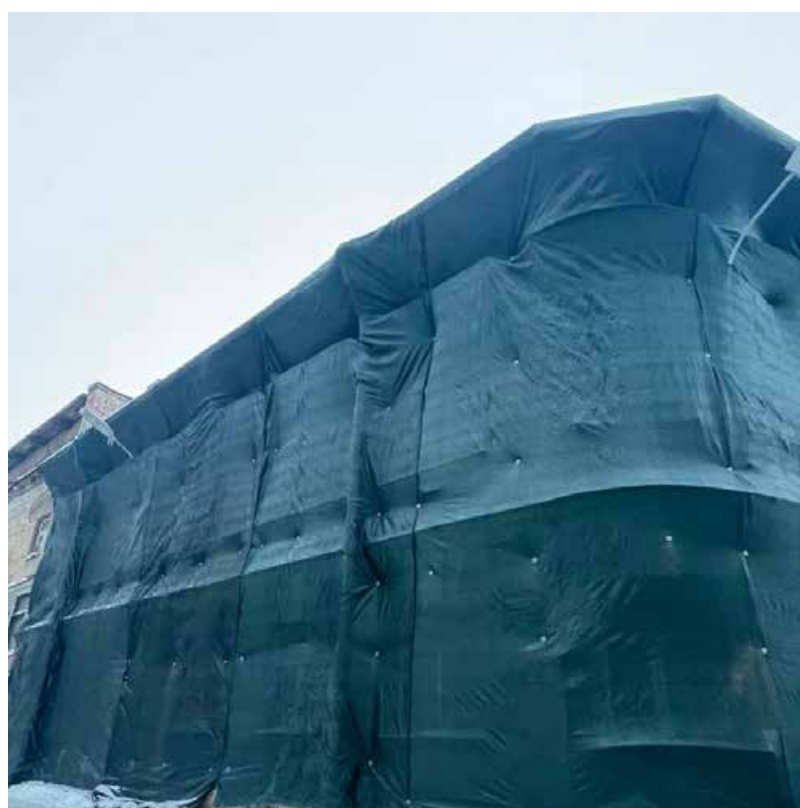
Фото 4. Общий вид вдоль Кожевенной линии. В настоящее время, на фасады здания установлены защитные укрывные сетки.
