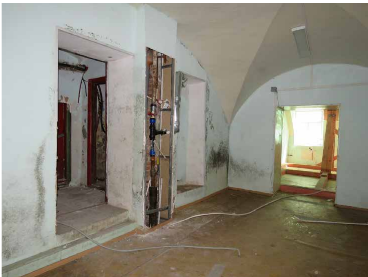
Фото 18. 1 этаж. Помещение 1-Н (№ 26). Общий вид.
