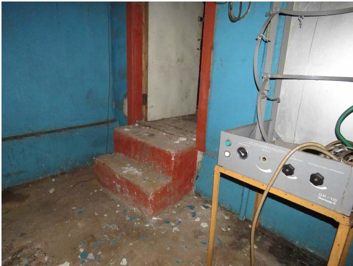
Фото 4. 1 этаж. Помещение 1-Н (№ 2). Вид на входные ступени.
