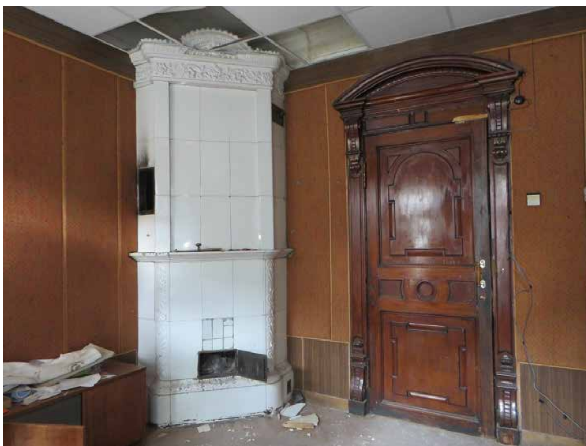
Фото 42. 2 этаж. Помещение 1-Н (№ 61). Общий вид исторической печи – Предмет охраны.
