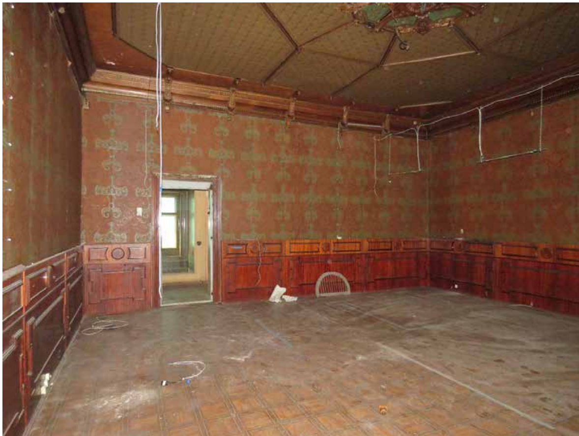
Фото 26. 2 этаж. Помещение 1-Н (№ 57). Общий вид. Предмет охраны.
