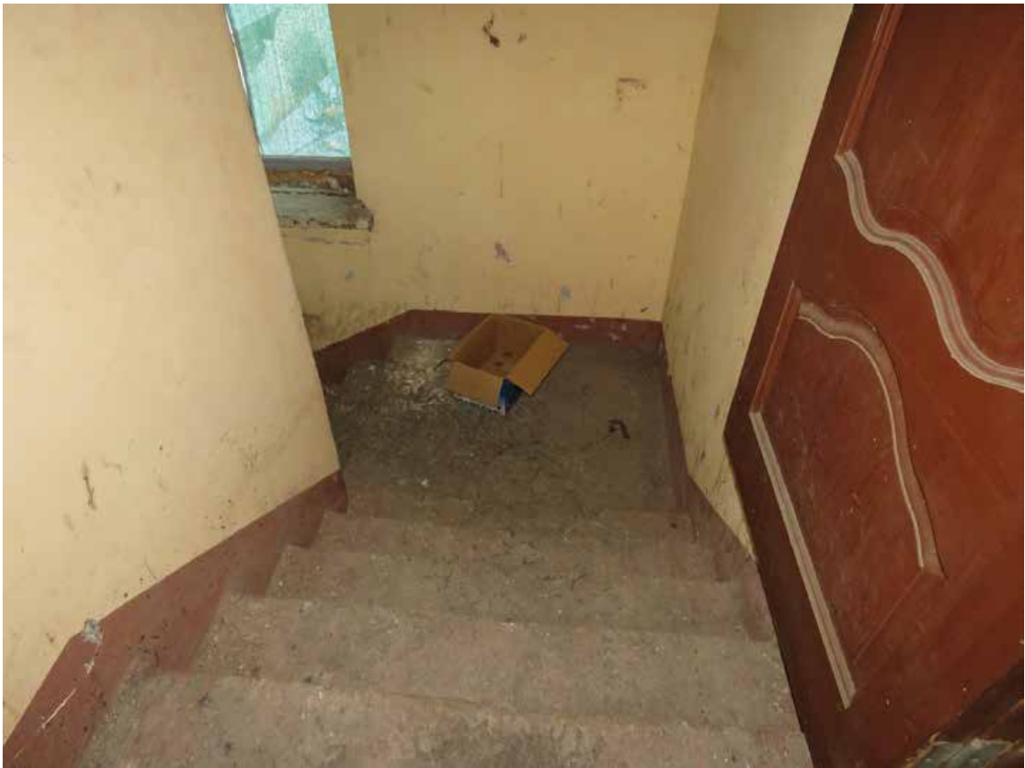
Фото 39. 2 этаж. Помещение 1-Н (№ 44). Лестница. Общий вид.
