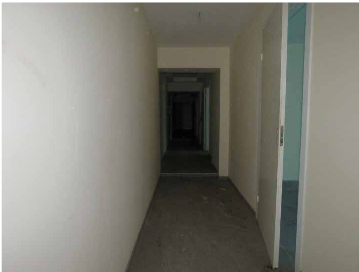
Фото 45. 3 этаж. Помещение 1-Н (№ 129). Общий вид коридора.
