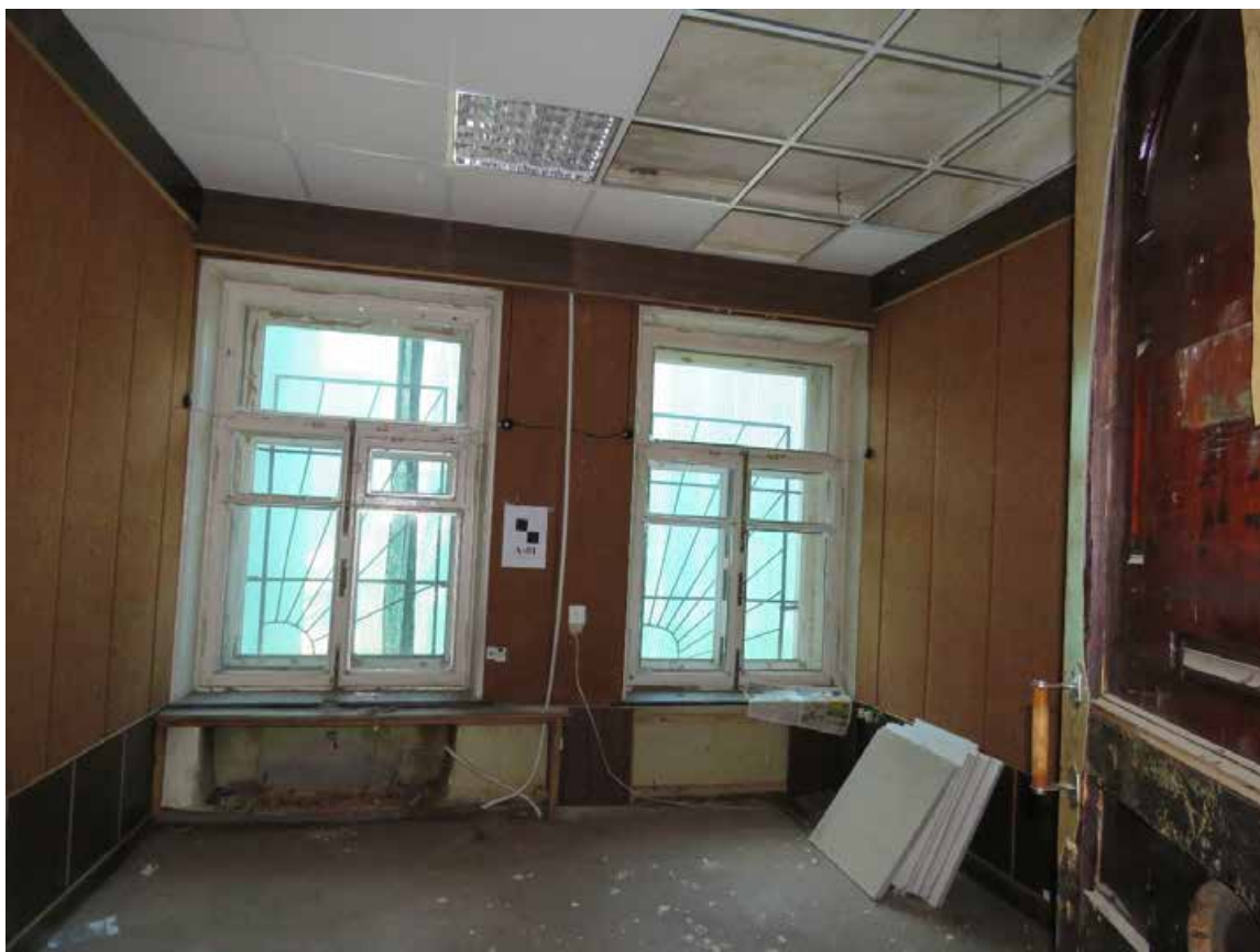
Фото 41. 2 этаж. Помещение 1-Н (№ 61). Общий вид.
