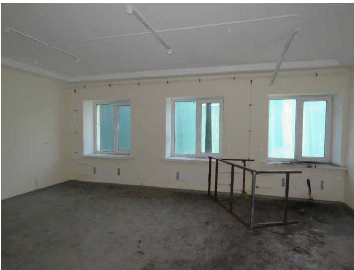
Фото 48. 3 этаж. Помещение 1-Н (№ 126/127). Общий вид.
