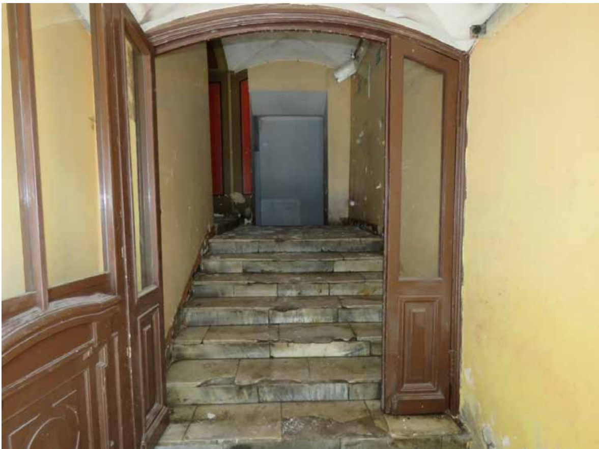
Фото 5. 1 этаж. Помещение 1-Н (№ 5). Общий вид.
