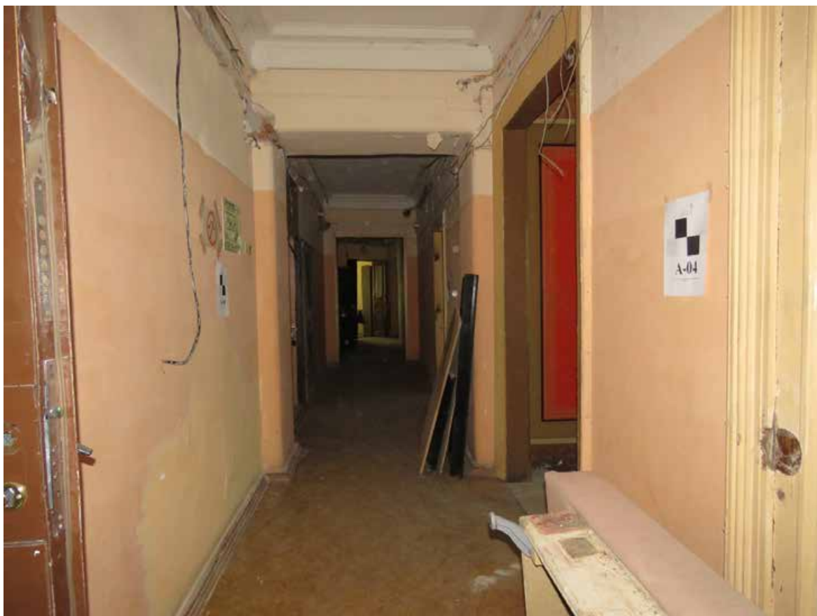
Фото 25. 2 этаж. Помещение 1-Н (№ 58). Общий коридора.
