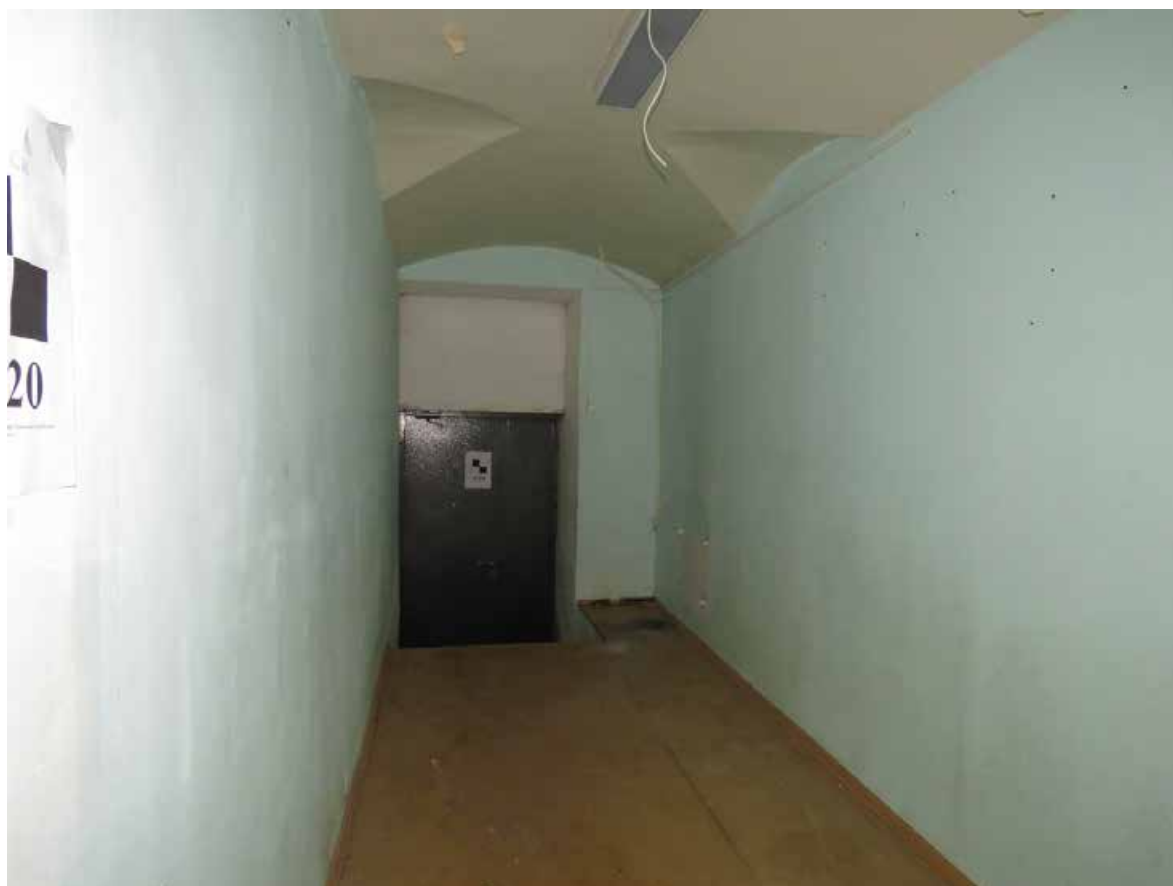
Фото 16. 1 этаж. Помещение 1-Н (№ 24). Общий вид.
