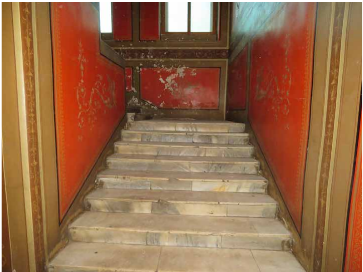
Фото 21. Лестница. Помещение 13-Н (№ 62). Общий вид.
