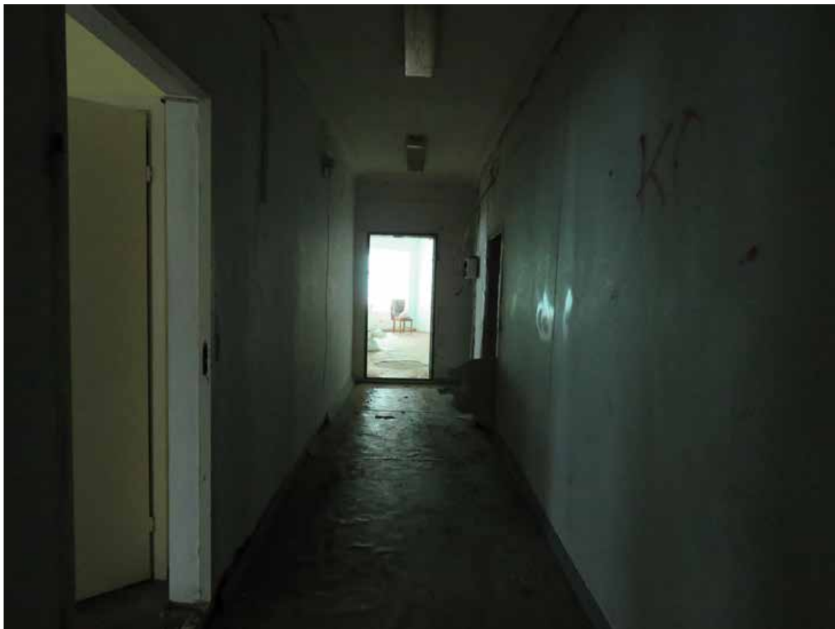
Фото 11. 1 этаж. Помещение 1-Н (№ 9). Общий вид коридора.
