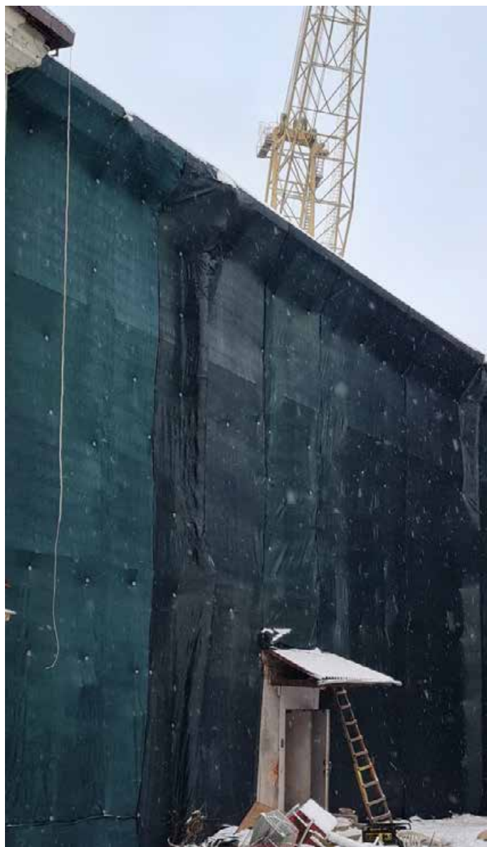
Фото 5. Общий вид дворового (юго-западного) фасада. В настоящее время, на фасады здания установлены защитные укрывные сетки.
