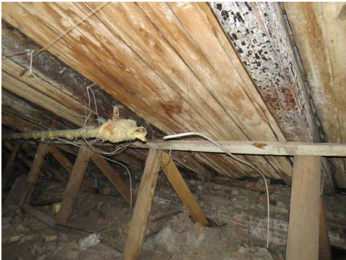
Фото 53. 3 этаж. Помещение чердака. Вид на стропила.
