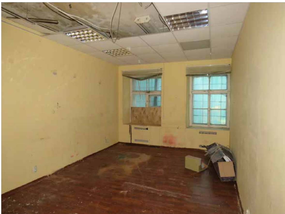
Фото 10. 1 этаж. Помещение 1-Н (№ 6).
