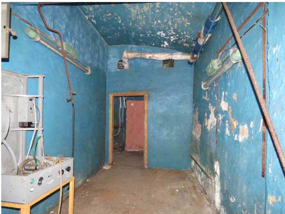
Фото 7. 1 этаж. Помещение 14-Н (№ 2). Вид на свод бывшего проезда.
