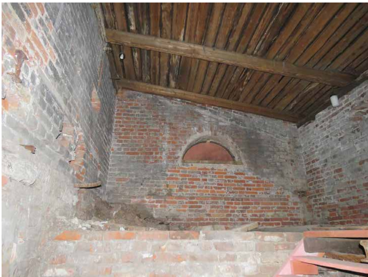
Фото 51. 3 этаж. Помещение чердака над лестницей. Общий вид.
