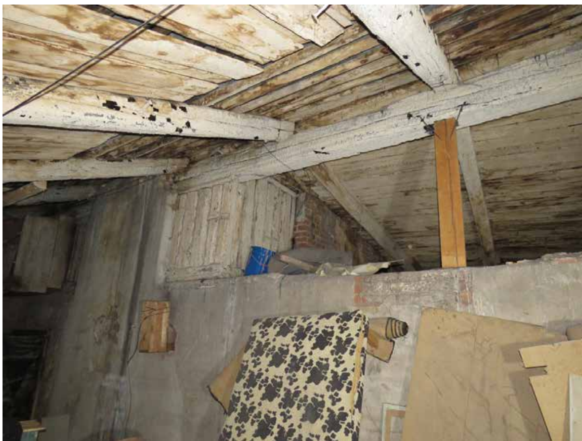
Фото 52. 3 этаж. Помещение чердака. Общий вид.
