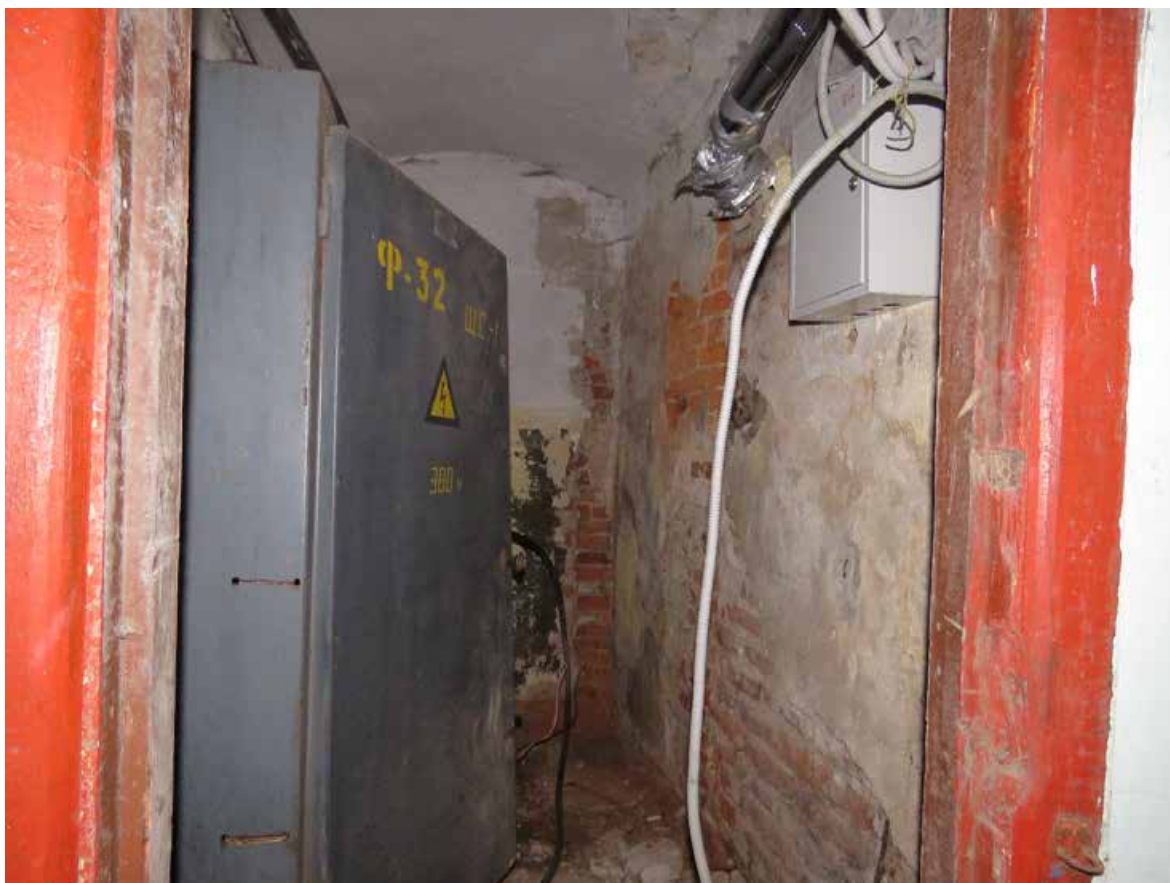
Фото 19. 1 этаж. Помещение 1-Н (№ 22). Общий вид.
