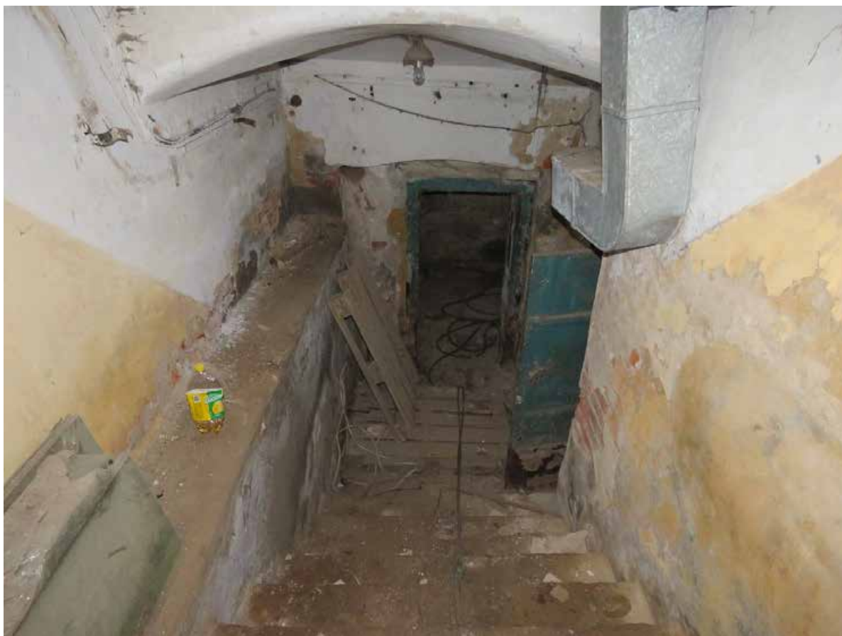
Фото 1. Подвал. Помещение 13-Н. Вход.
