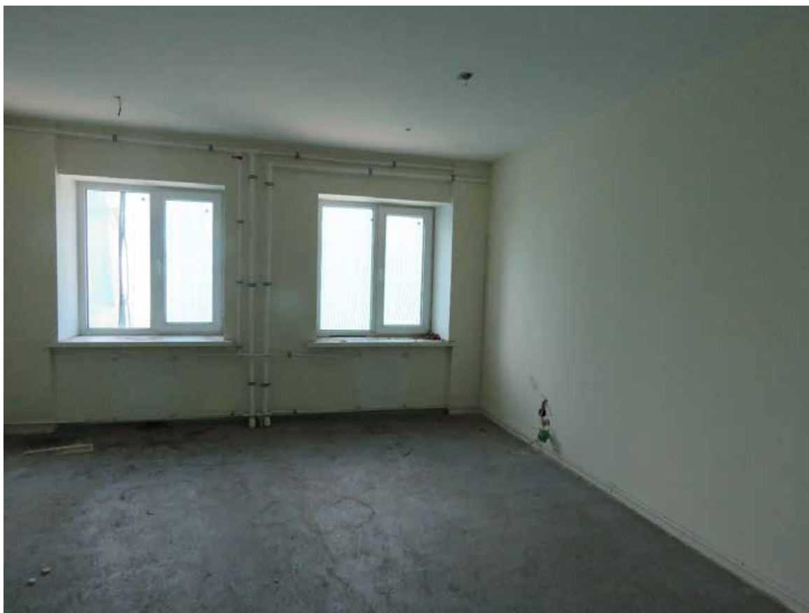
Фото 46. 3 этаж. Помещение 1-Н (№ 130). Общий вид.
