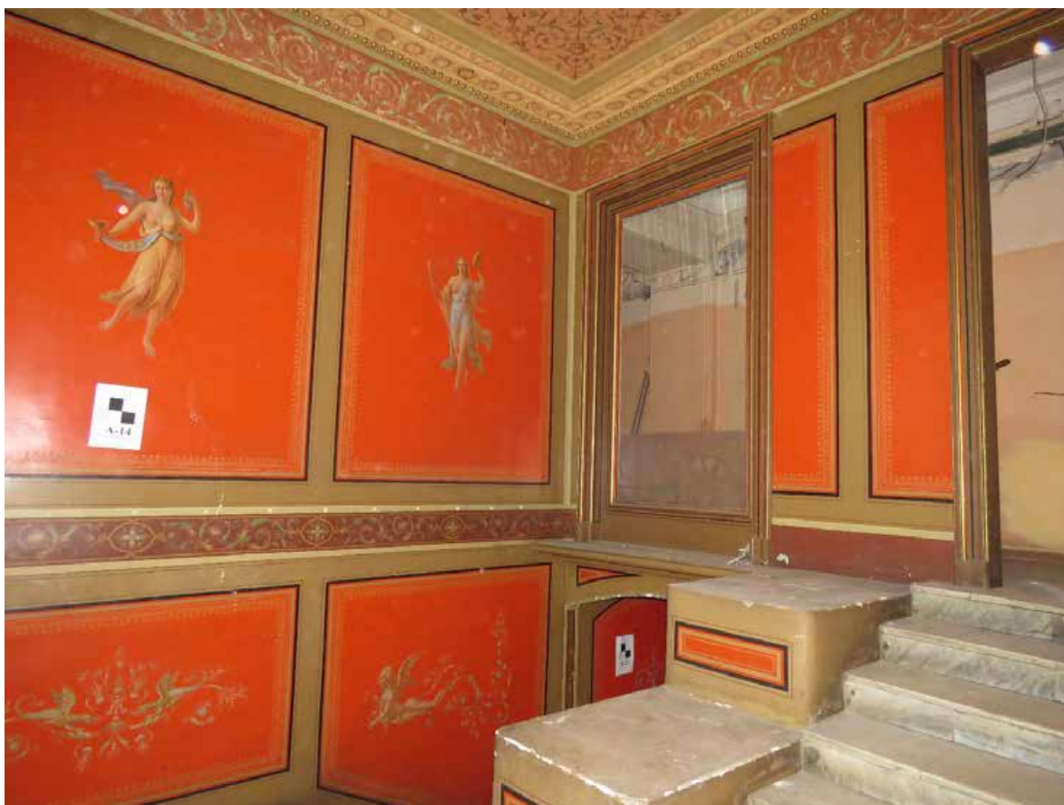
Фото 24. Лестница. Помещение 1-Н (№ 62). Общий вид.
