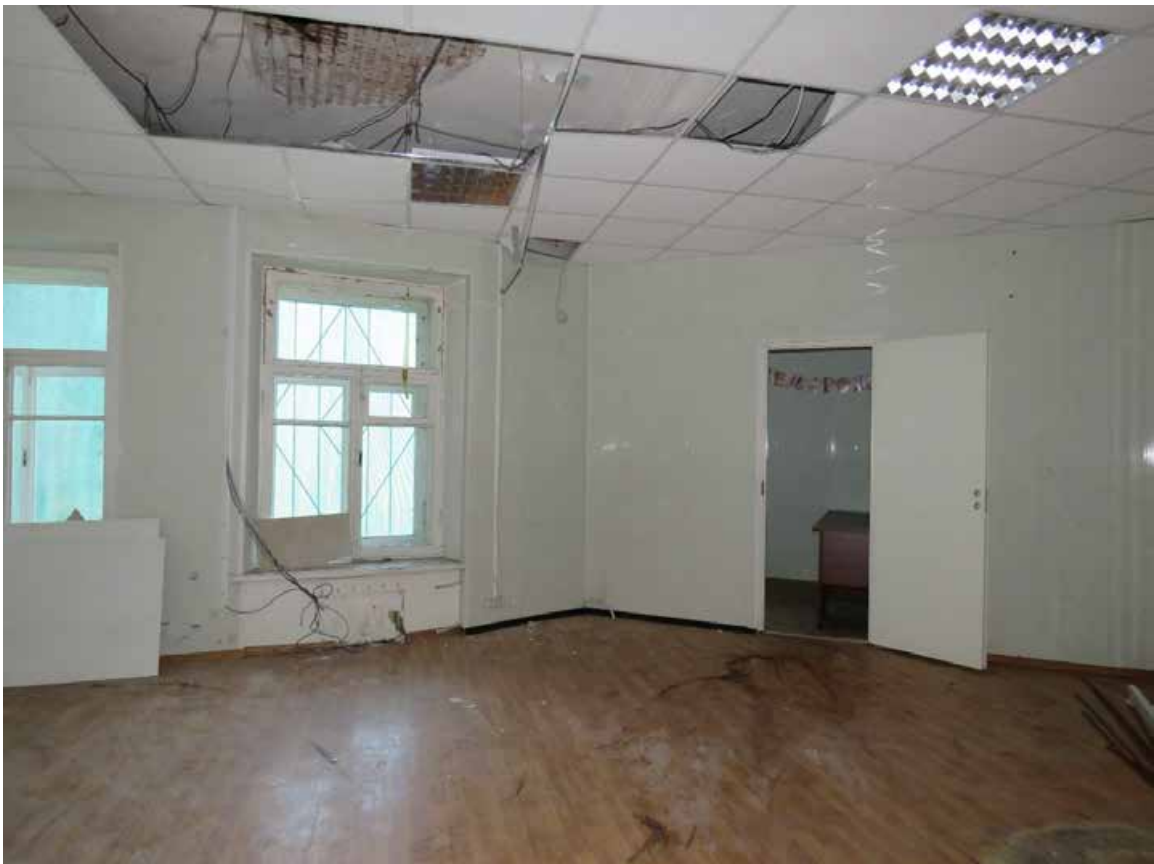
Фото 40. 2 этаж. Помещение 1-Н (№ 59). Общий вид.
