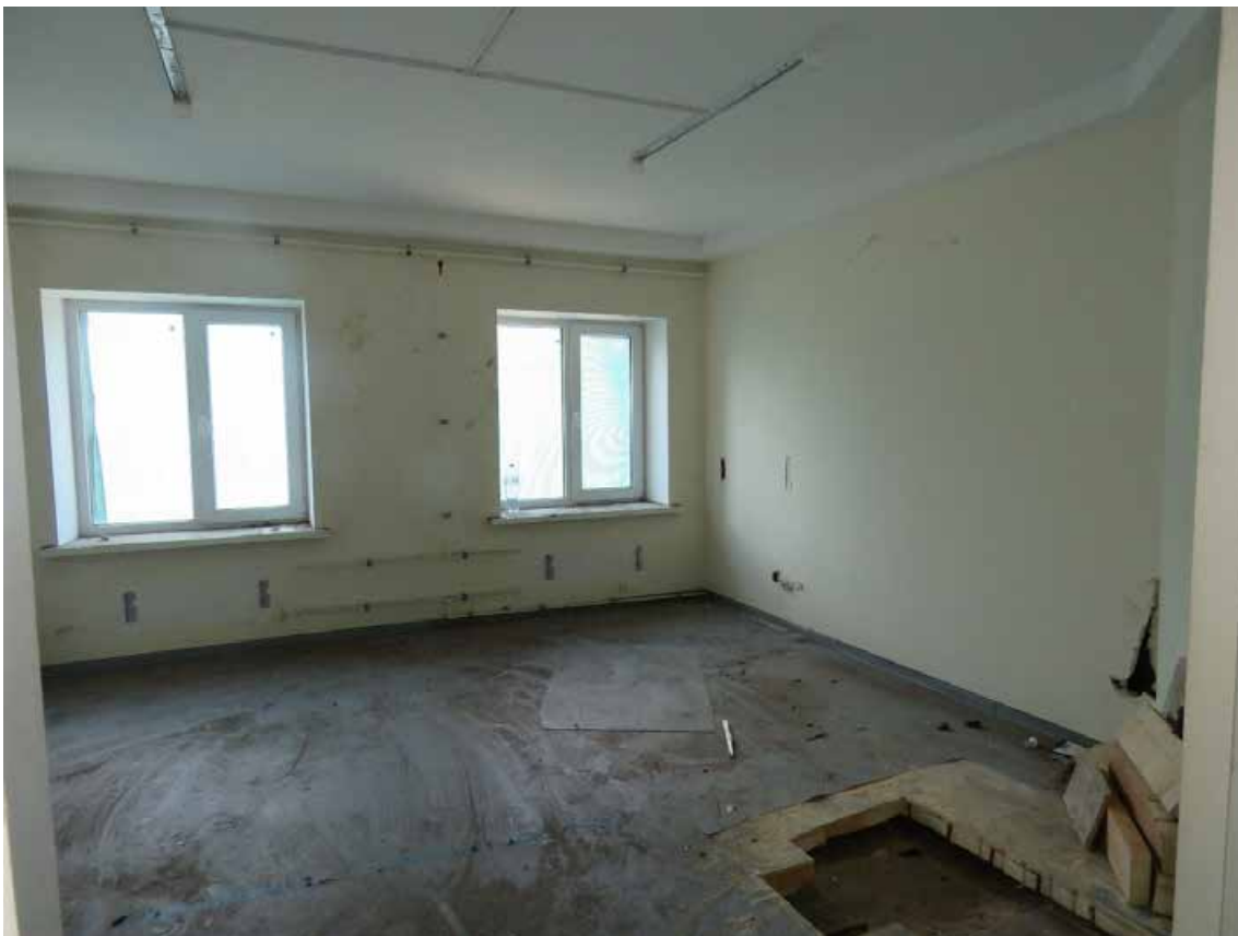
Фото 47. 3 этаж. Помещение 1-Н (№ 128). Общий вид.
