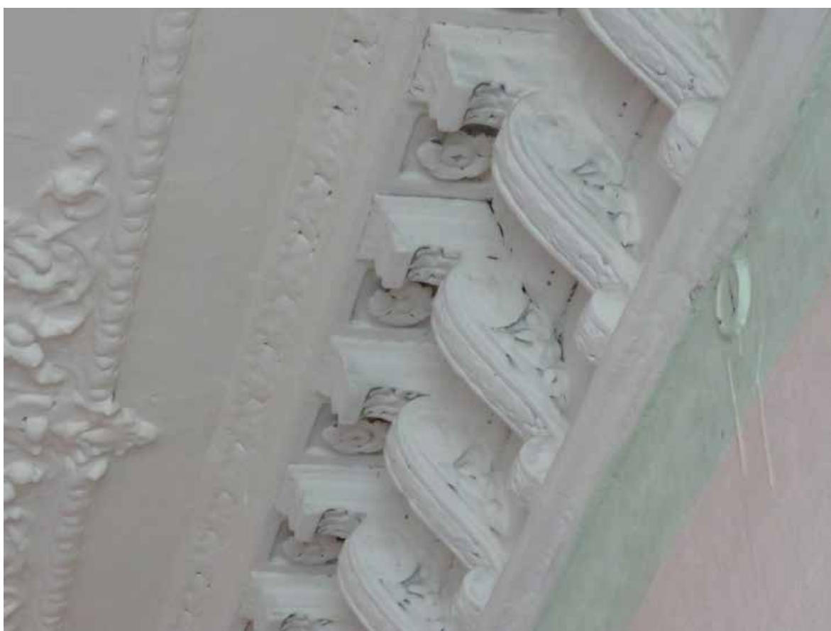
Фото 32. 2 этаж. Помещение 1-Н (№ 56). Декор карниза.
