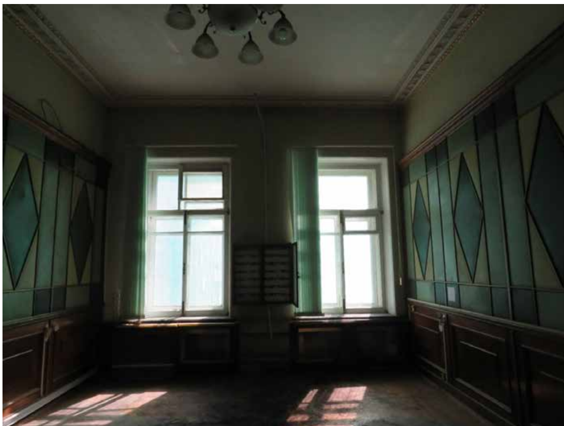
Фото 38. 2 этаж. Помещение 1-Н (№ 51). Общий вид.
