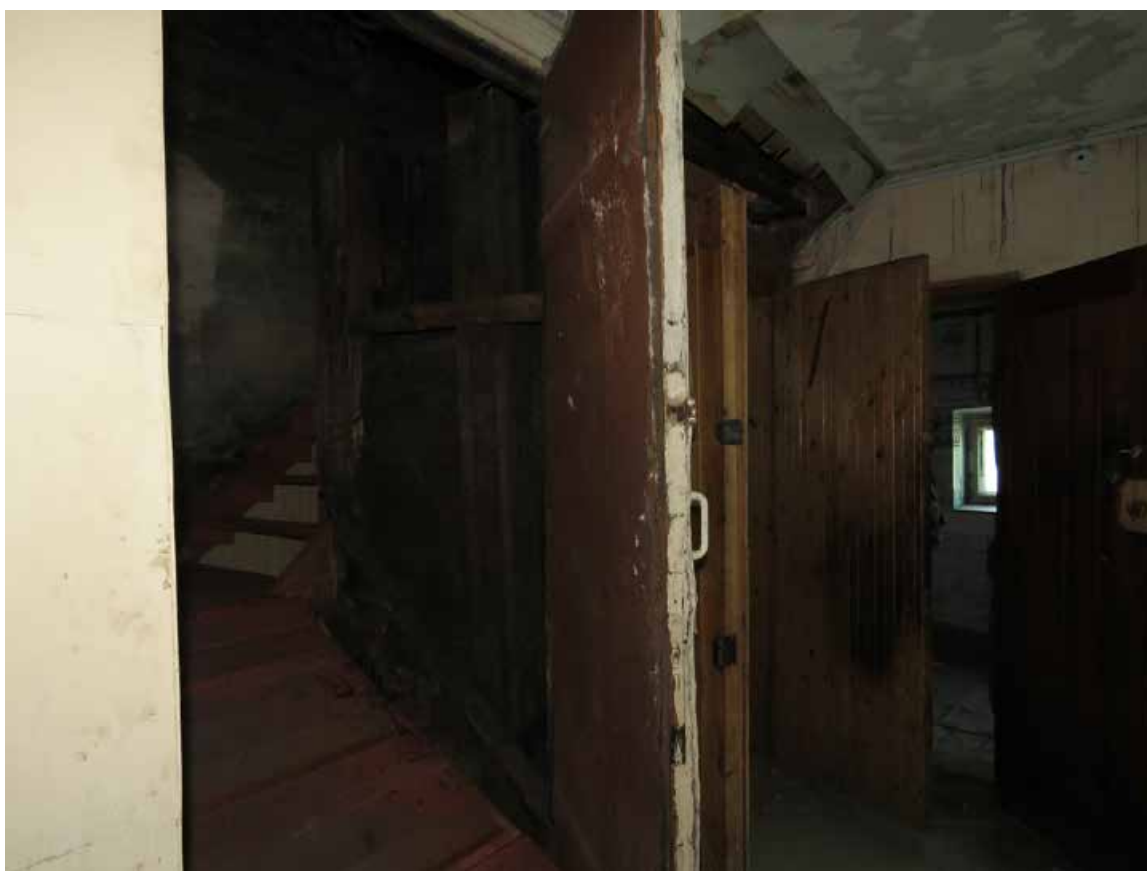
Фото 50. 3 этаж. Помещение 1-Н (№ 117). Общий вид.
