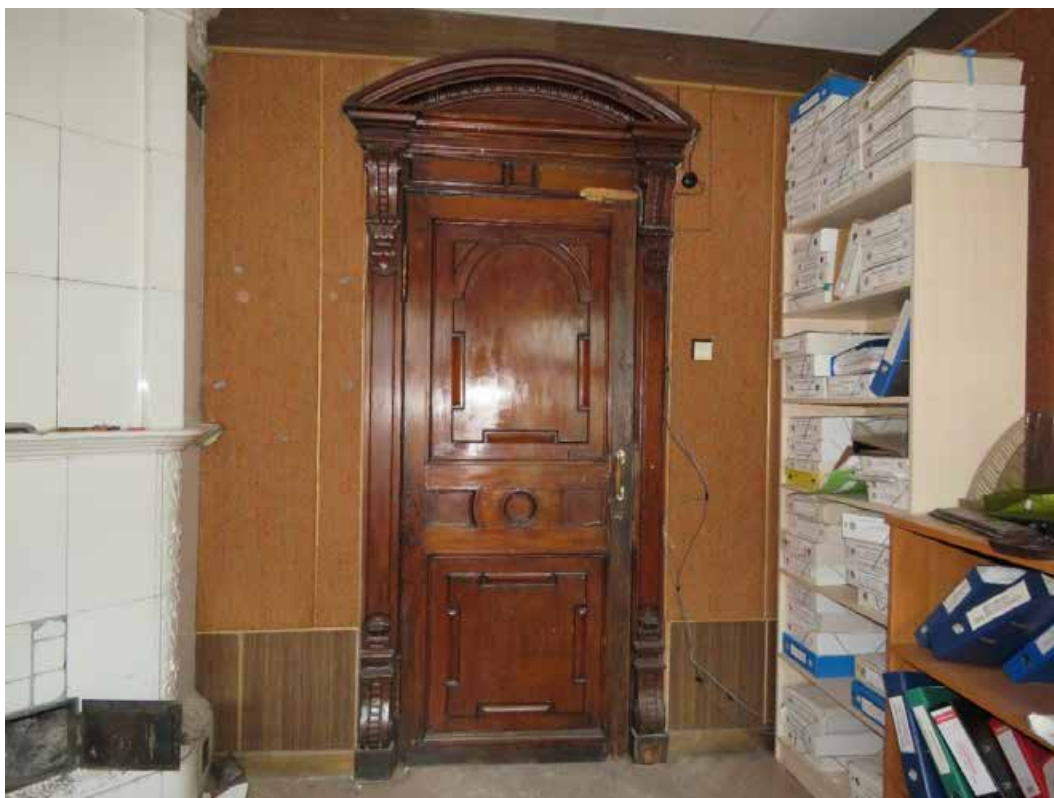
Фото 43. 2 этаж. Помещение 1-Н (№ 61). Общий вид двери с порталом – Предмет охраны.
