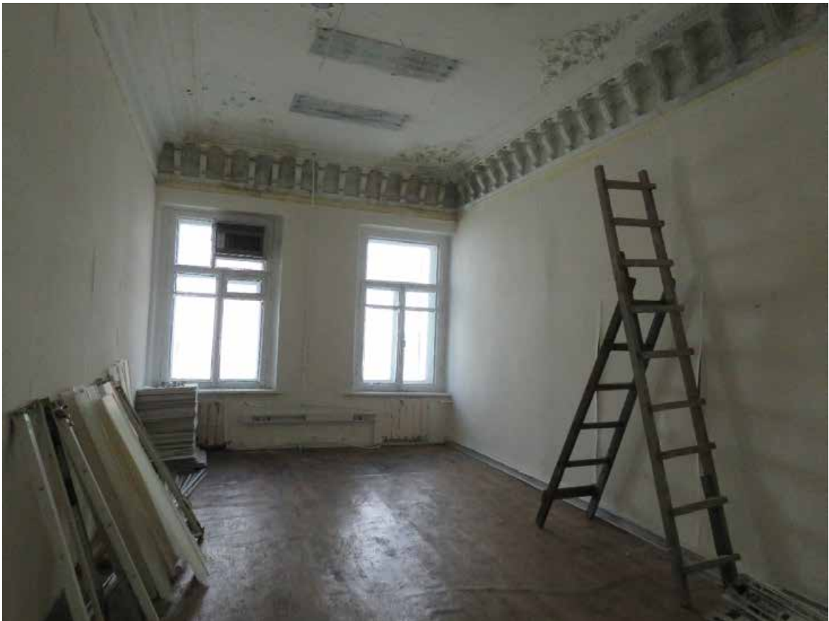
Фото 33. 2 этаж. Помещение 1-Н (№ 55). Часть общего помещения с пом. 56.
