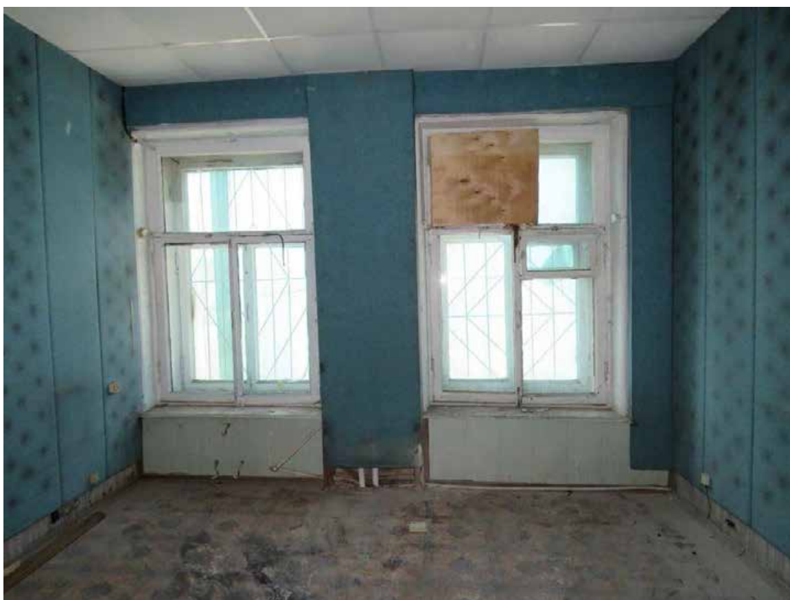
Фото 44. 2 этаж. Помещение 1-Н (№ 63). Общий вид.
