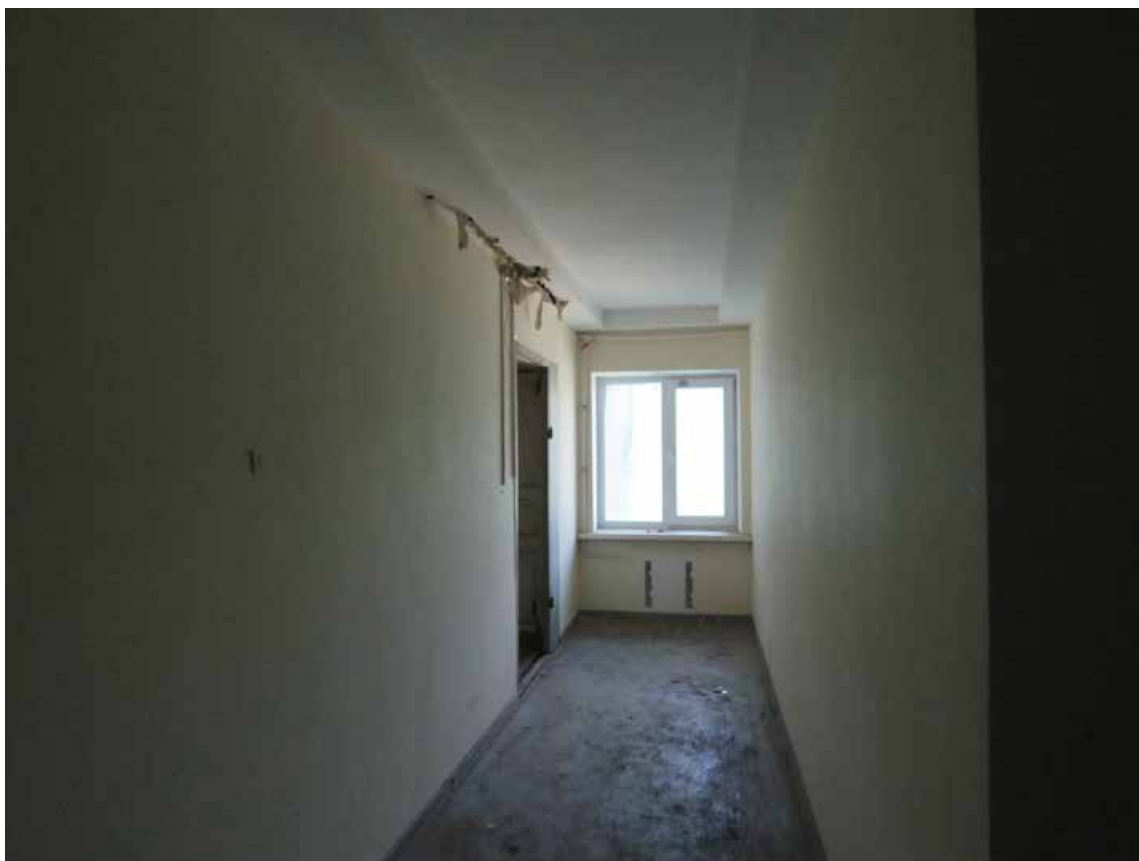
Фото 49. 3 этаж. Помещение 1-Н (№ 124). Общий вид.
