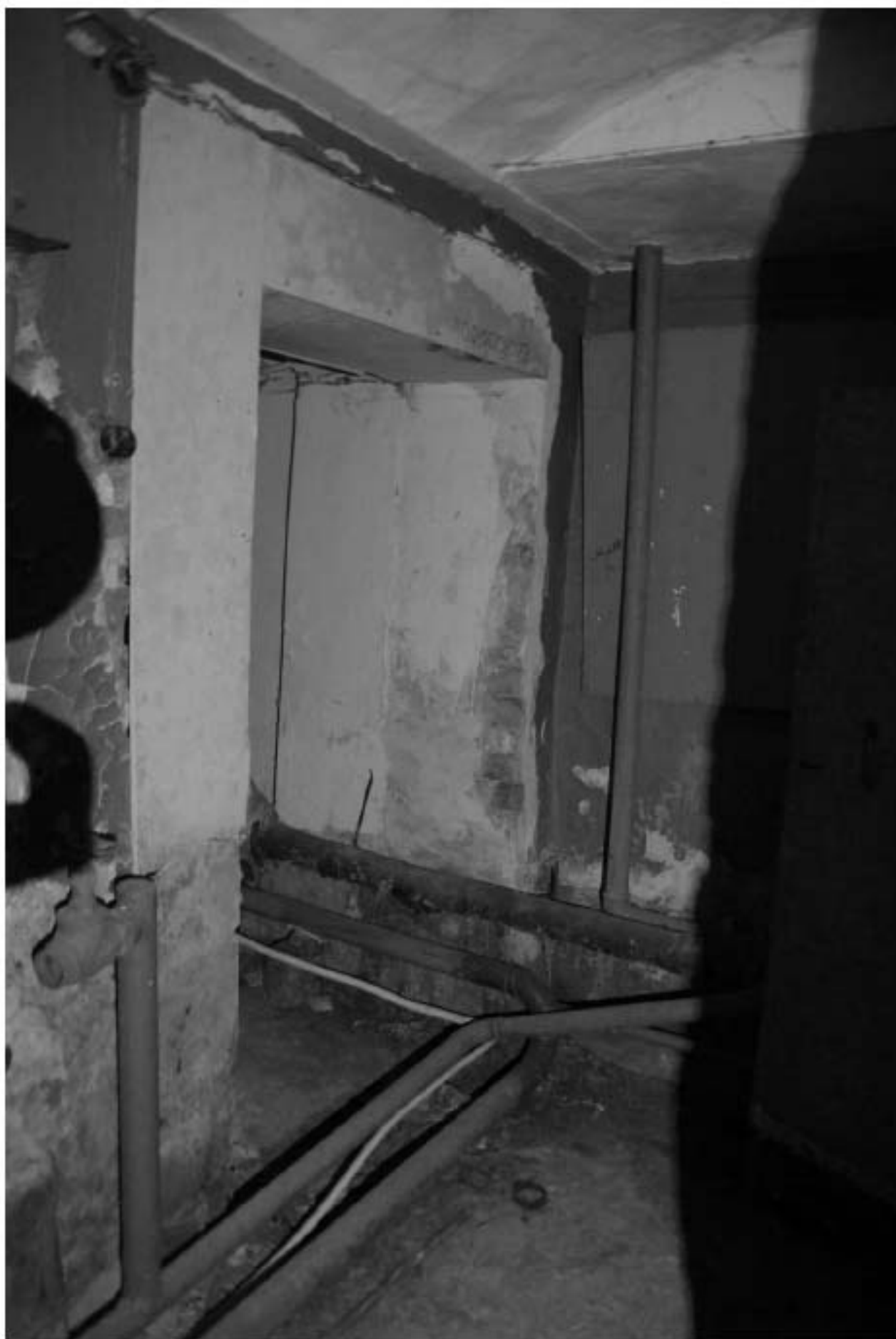
946. Подвал. Интерьер помещения 29-Н.
