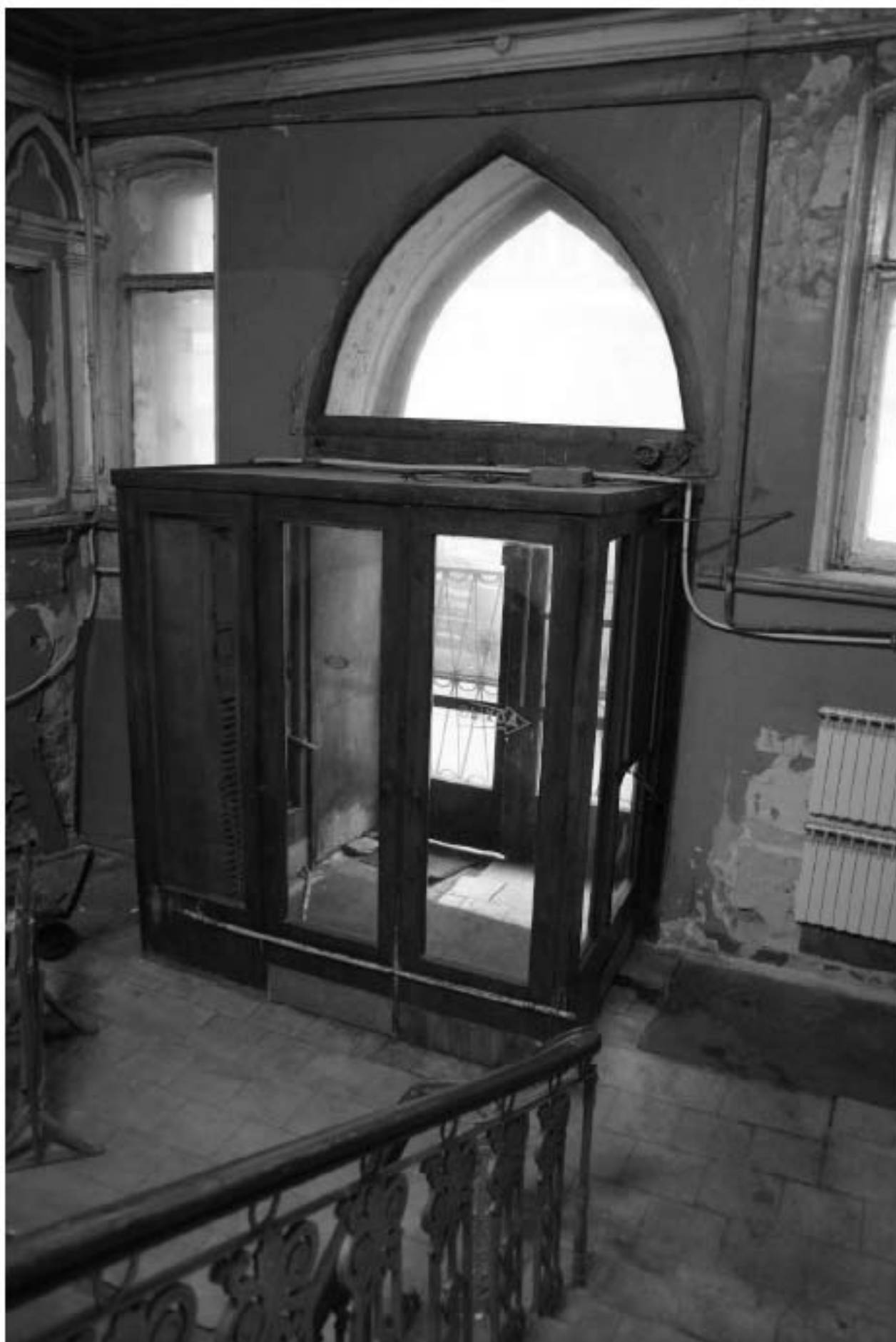
112. Вид на тамбур парадного входа.
