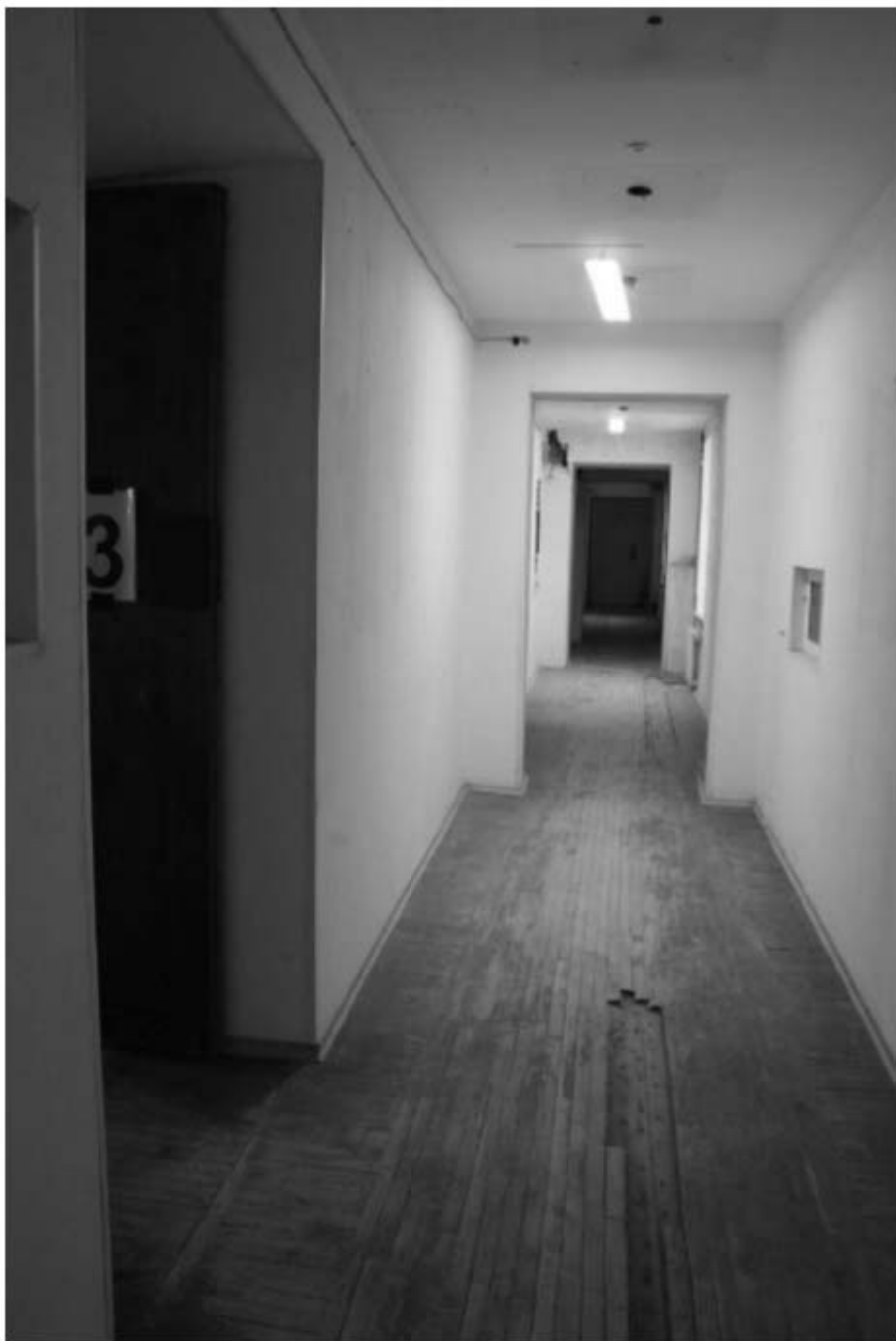
815. Этаж 5, помещение 19-Н. Вид коридора.
