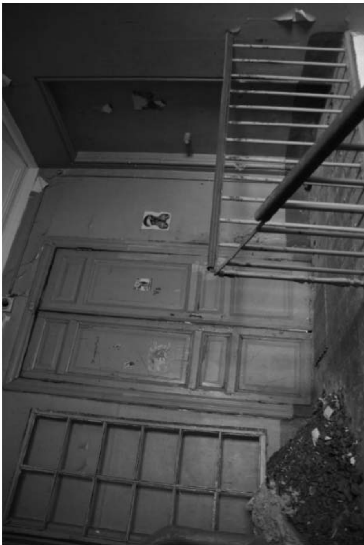
211. Лестница ЗЛК. Входная дверь лестничной площадки 5 этажа.
