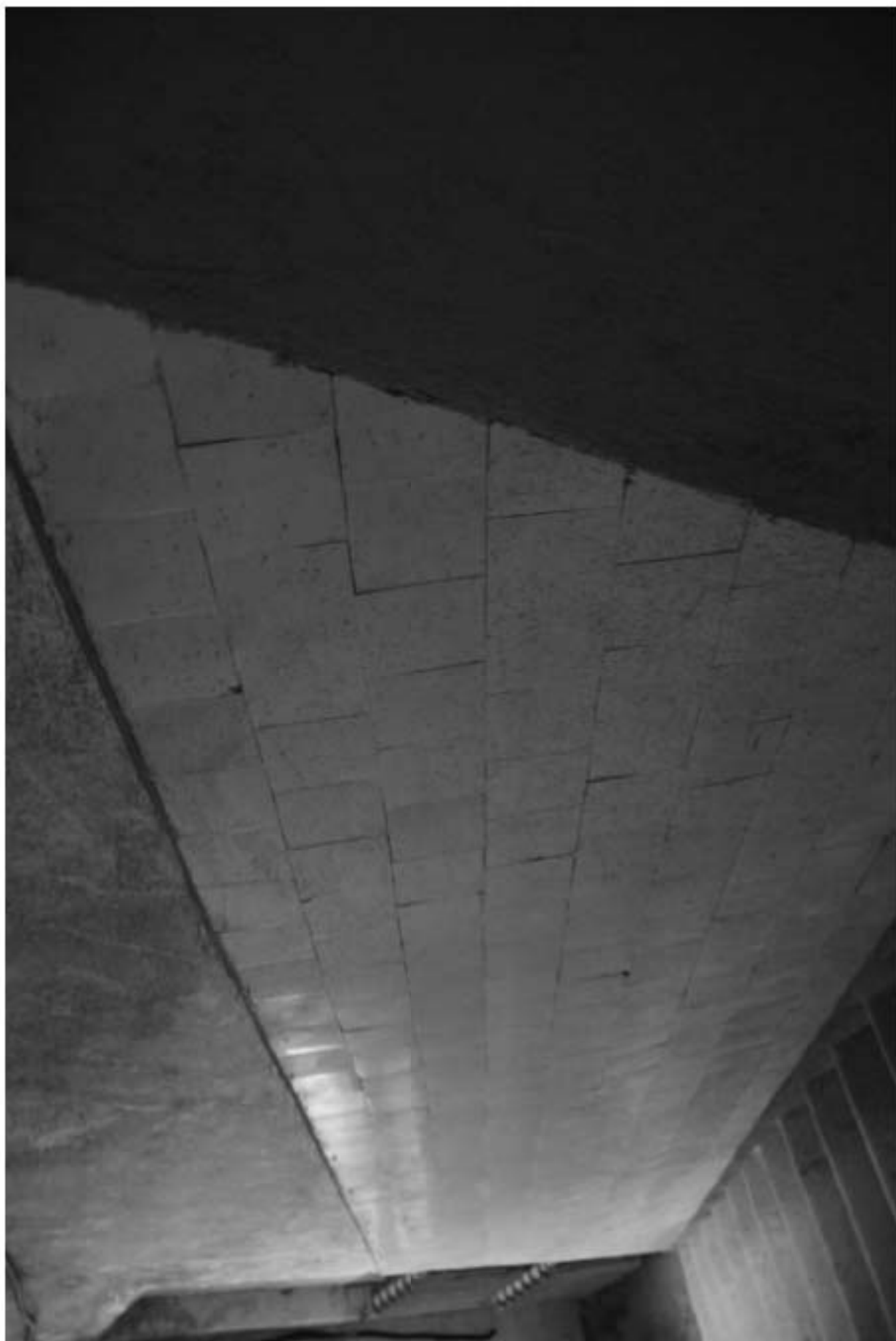
225. Лестница 4ЛК. Отделка стен.
