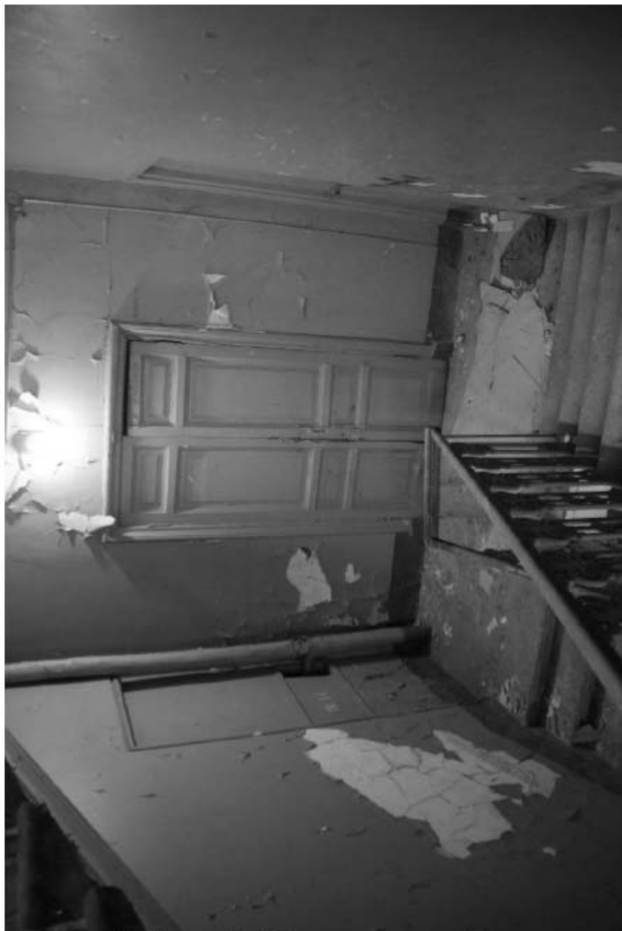
1799. Лестница ЗЛК. Лестничная площадка 3 этажа.
