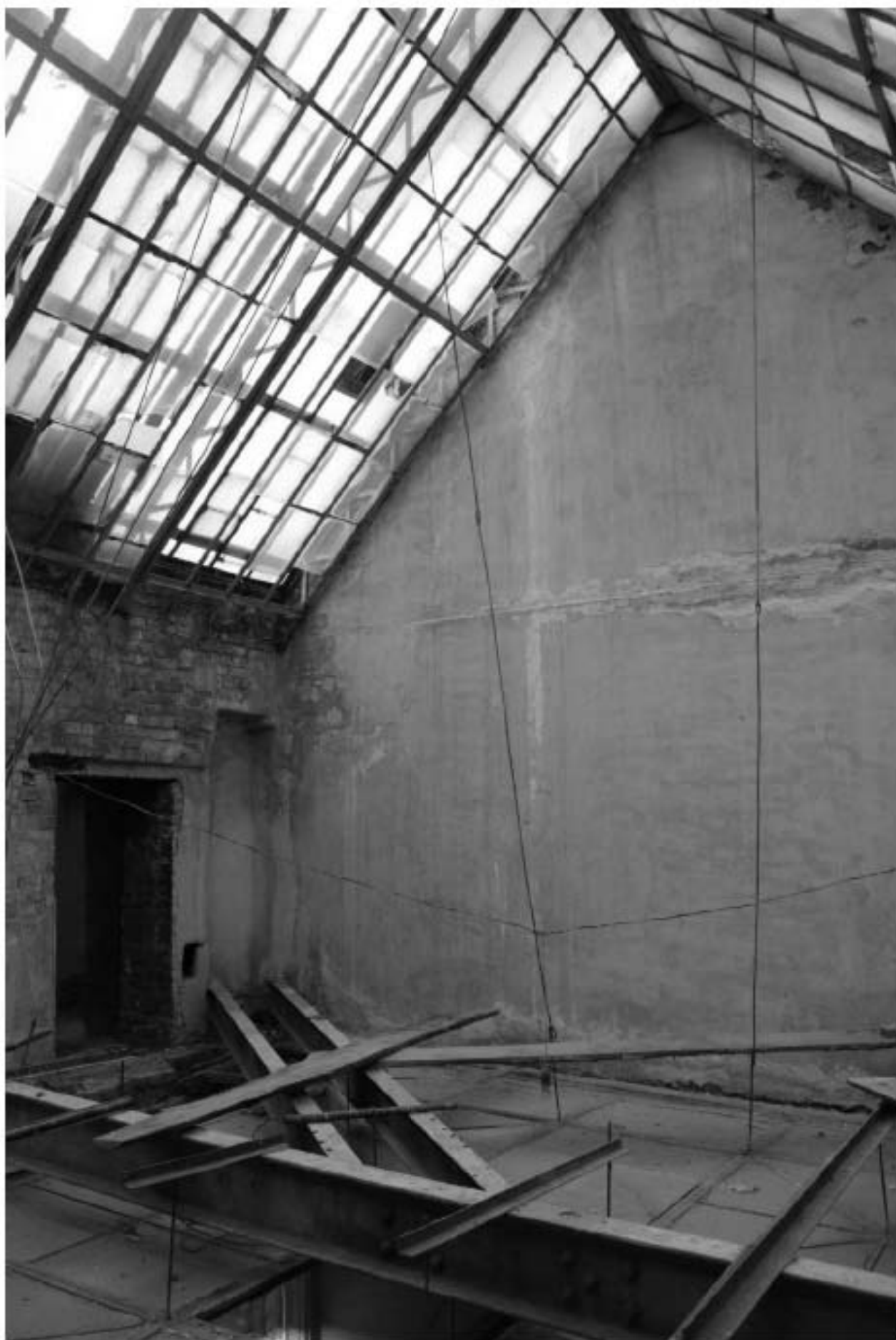
894. Чердак. Вид на конструкции светового фонаря.
