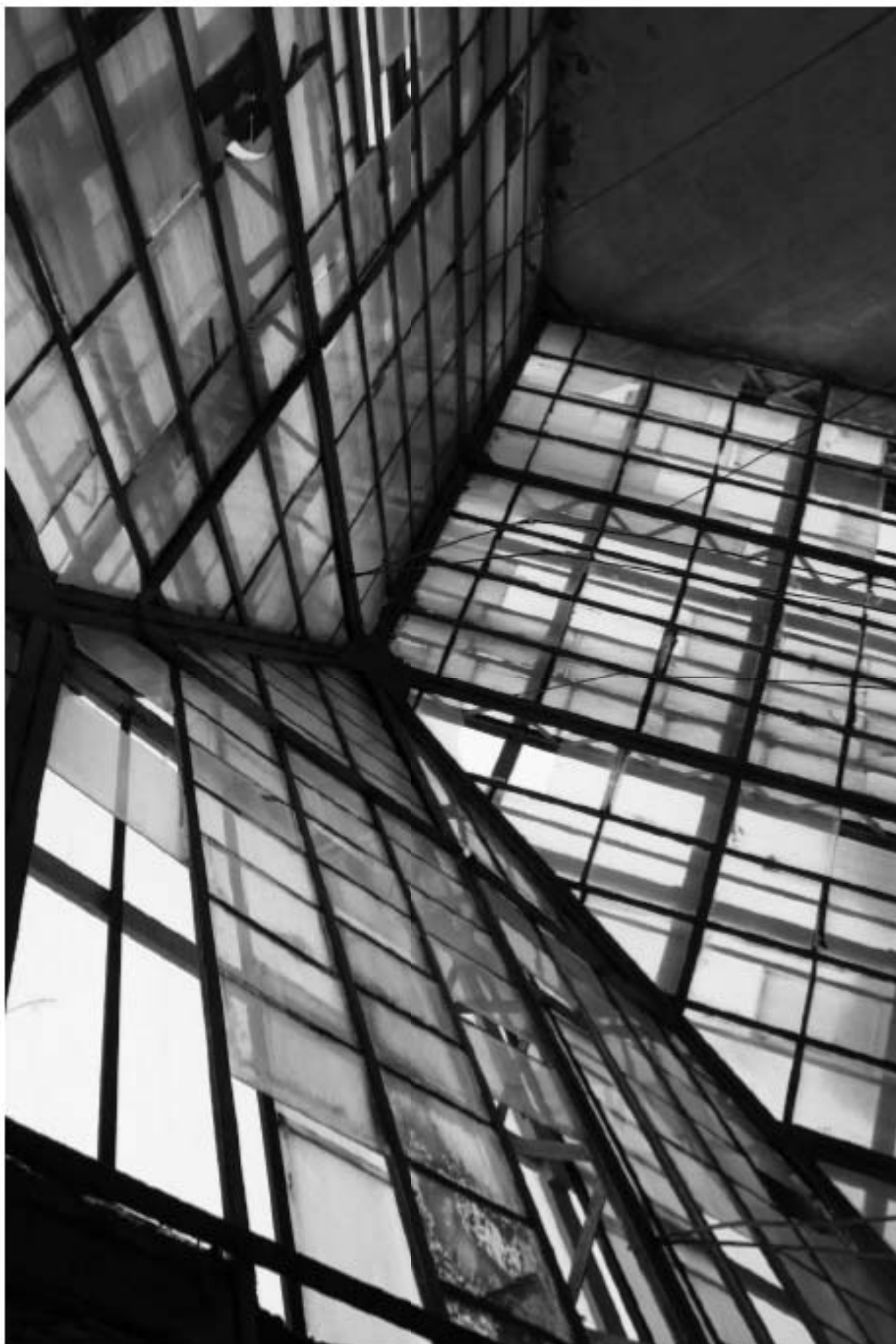
895. Чердак. Вид на конструкции светового фонаря.
