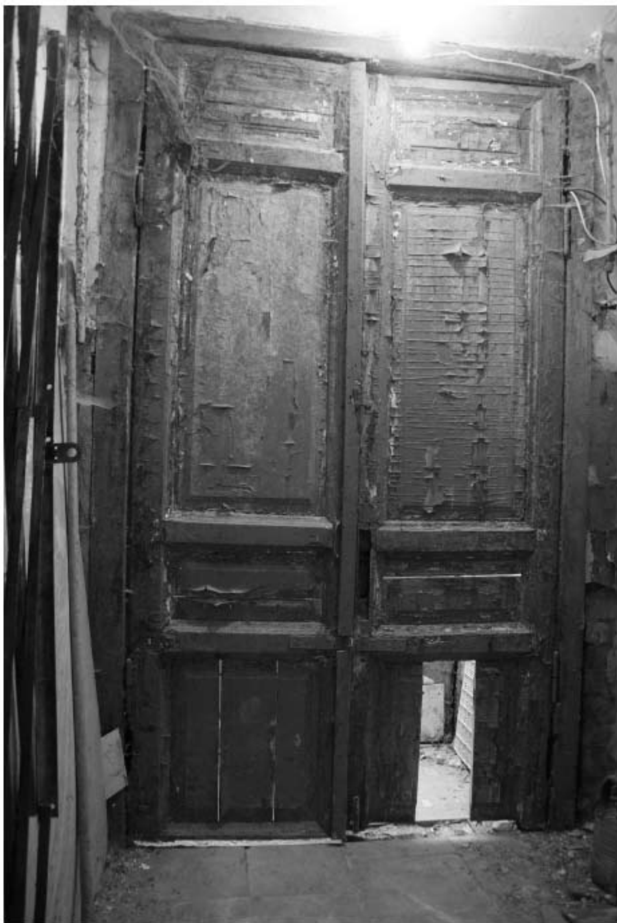
215. Лестница 4ЛК. Входная дверь.
