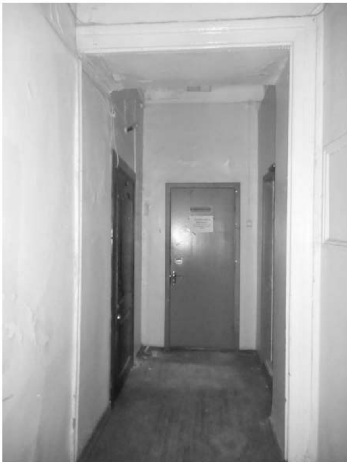
780. Этаж 4, помещение 40-Н. Вид коридора.
