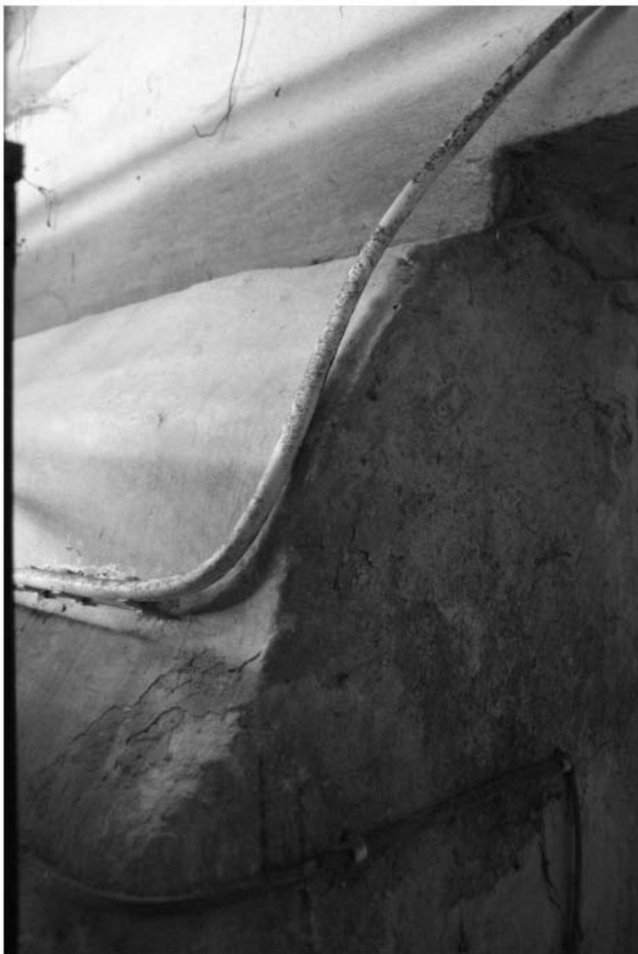
1046. Подвал, помещение 2-Н. Вид входного проёма в комнату 20,1 кв.м.
