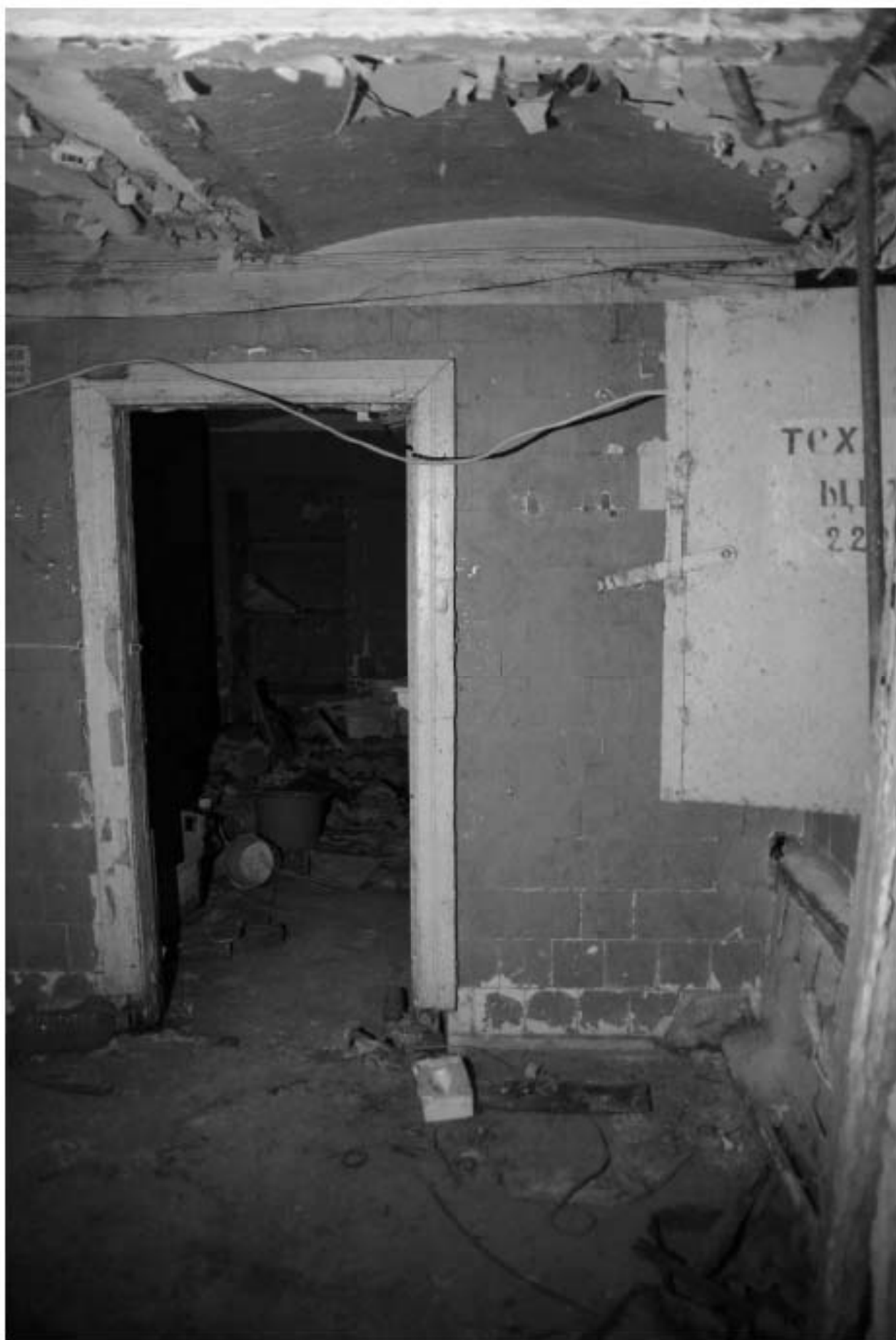
964. Подвал, помещение 6-Н. Интерьер комнаты 2,2 кв.м.
