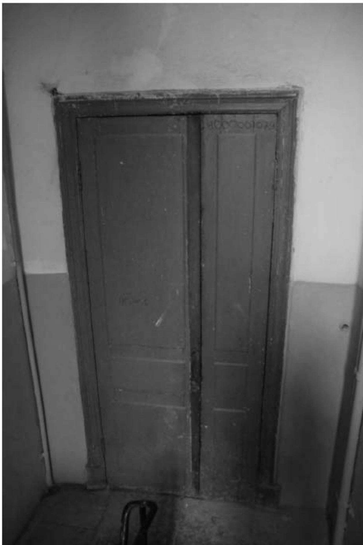
872. Лестница 2ЛК, третий этаж. Вид входной двери в помещение 37-Н.
