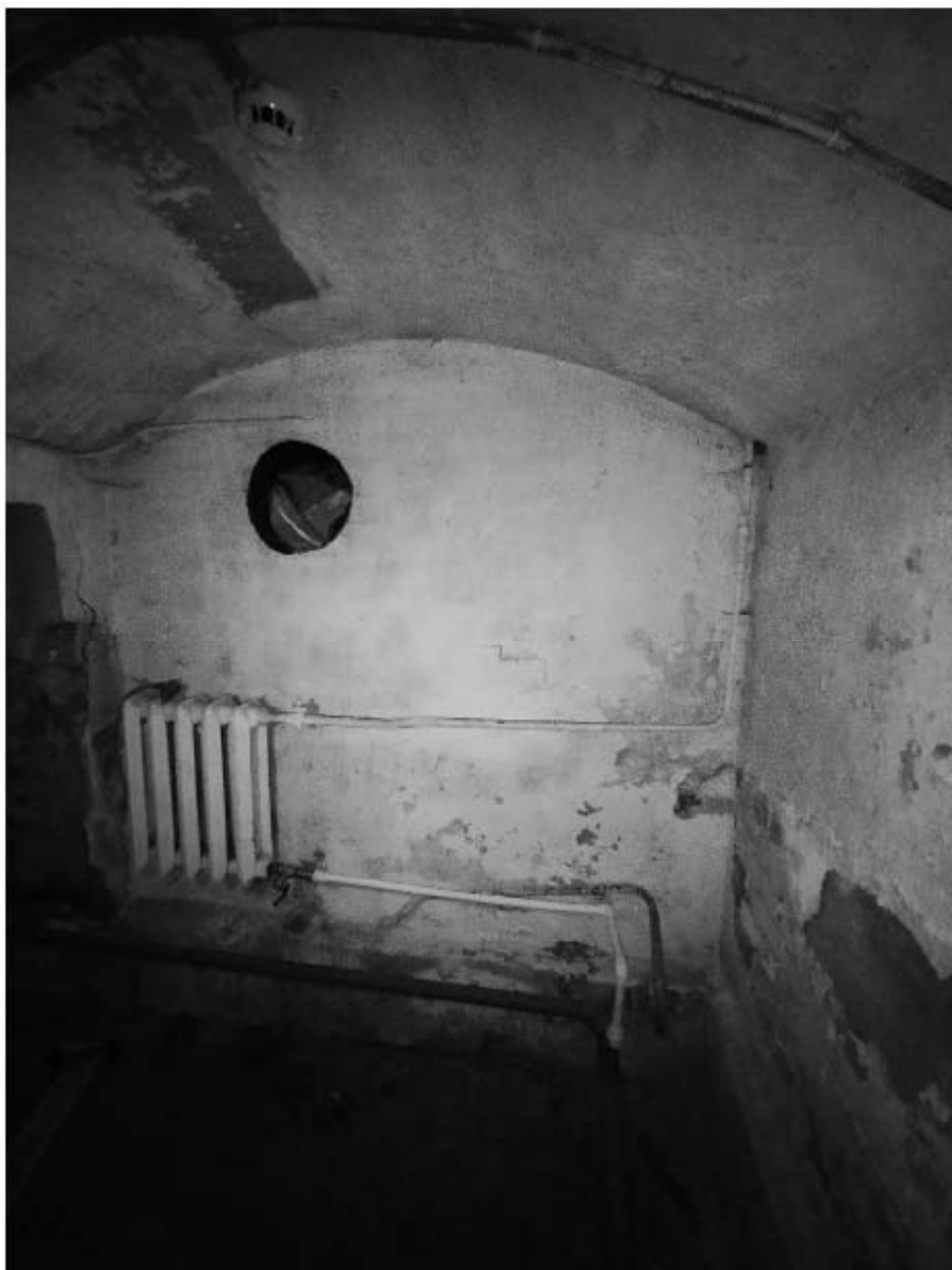
995. Подвал, помещение 6-Н. Интерьер комнаты 4,3 кв.м.
