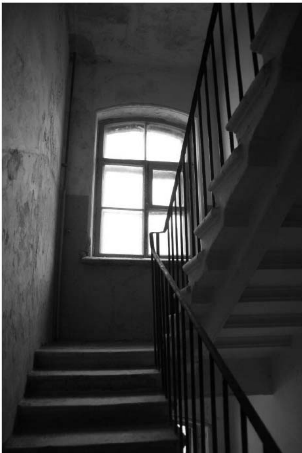
1377. Лестница 2ЛК. Лестничная площадка между 4 и 5 этажами.
