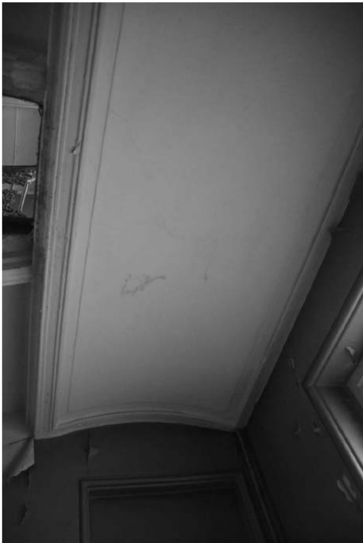
1698. Лестница 3ЛК. Своды лестничной площадки.
