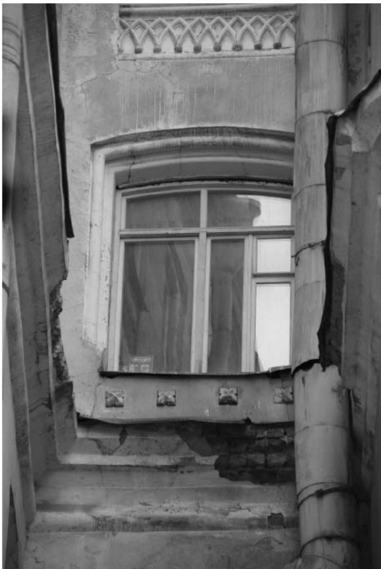
83. Фрагмент дворового фасада.
