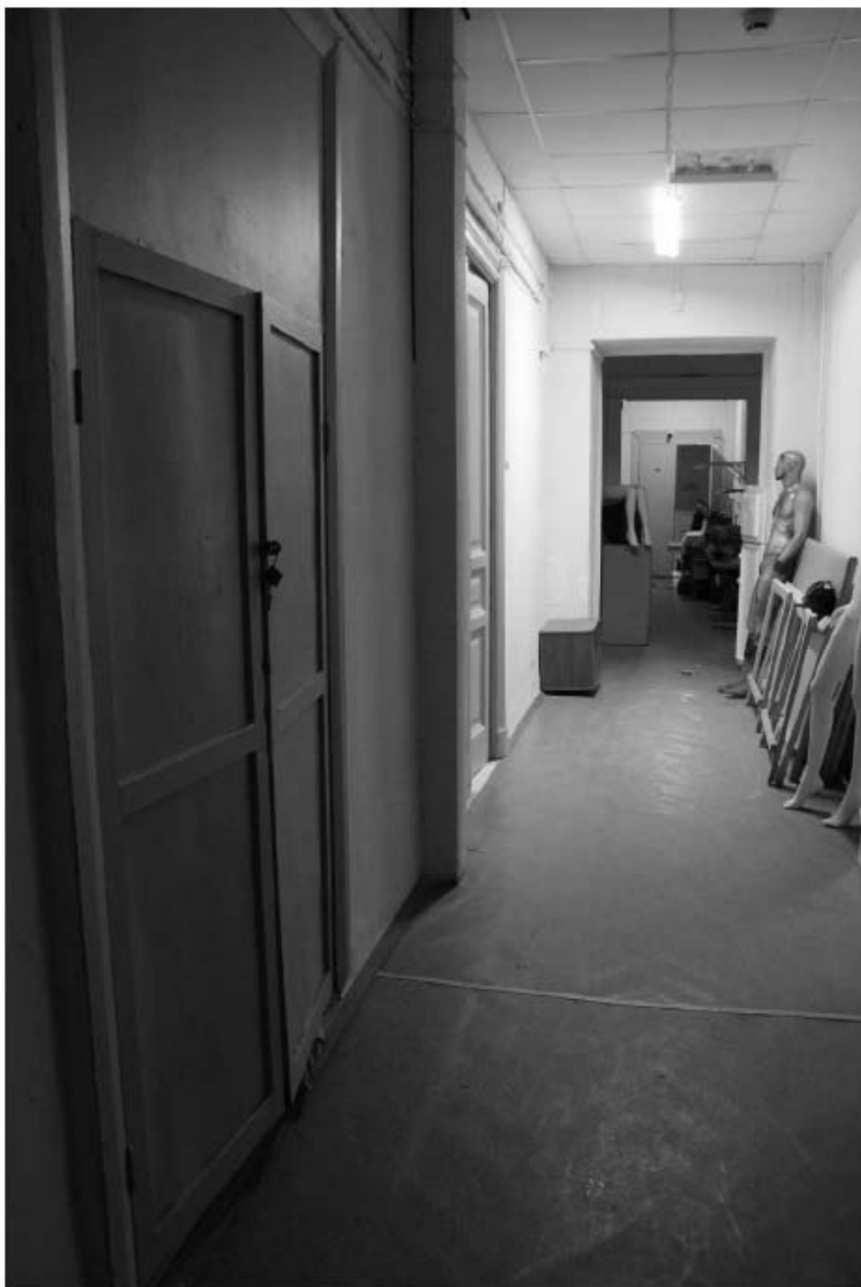
510. Этаж 2, помещение 16-Н. Интерьер коридора.
