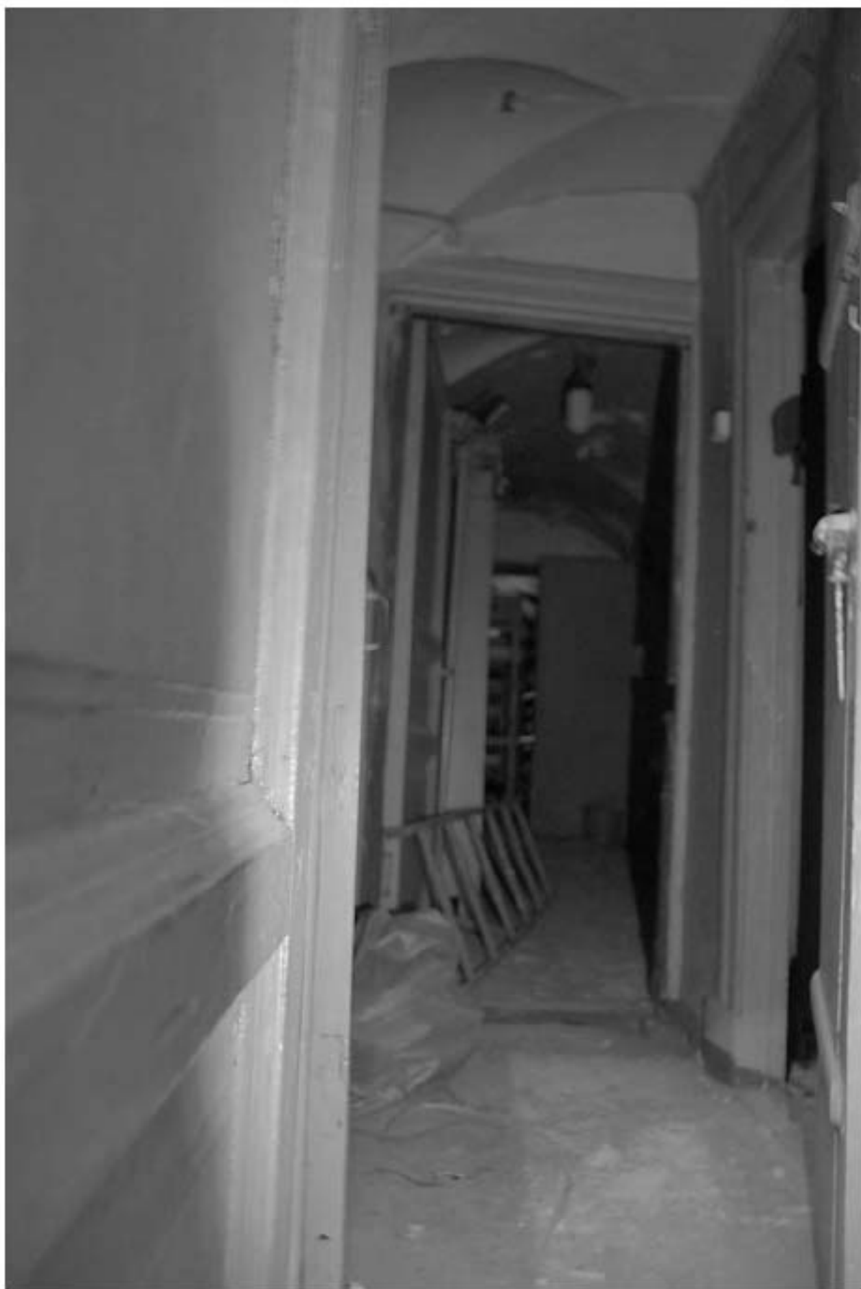
1014. Подвал, вход в помещение 10-Н с лестницы 2ЛК.
