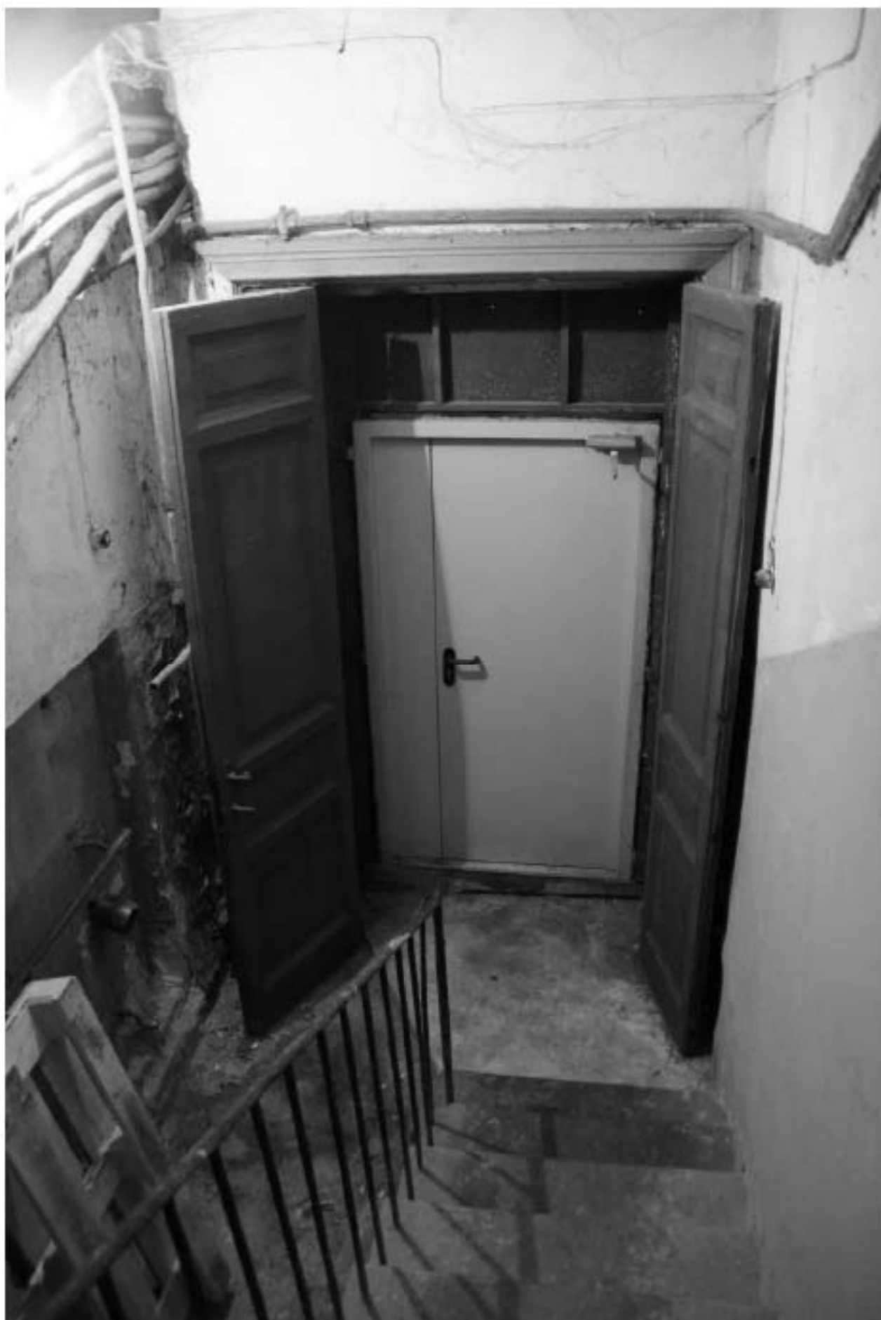
162. Лестница 2ЛК. Тамбур входной двери.
