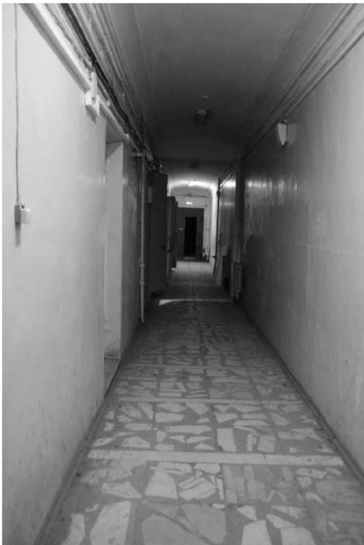
305. Этаж 1, помещение 15-Н. Вид коридора.
