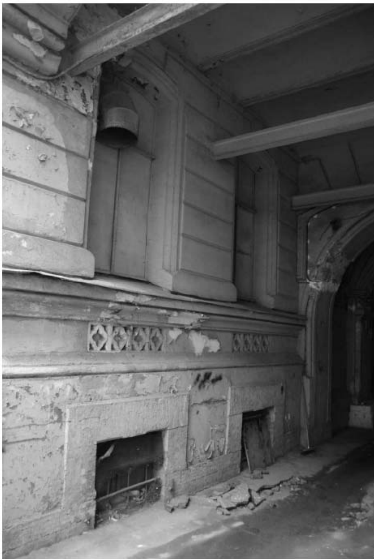
56. Воротный проезд лицевого корпуса. Фрагмент.
