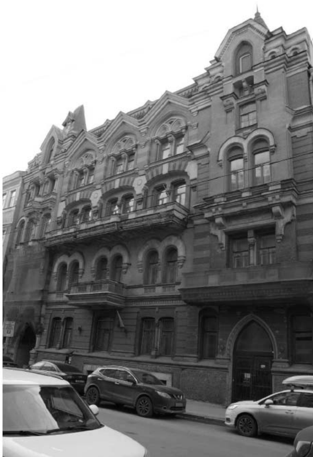
1. Лицевой фасад. Вид с северо-востока.
