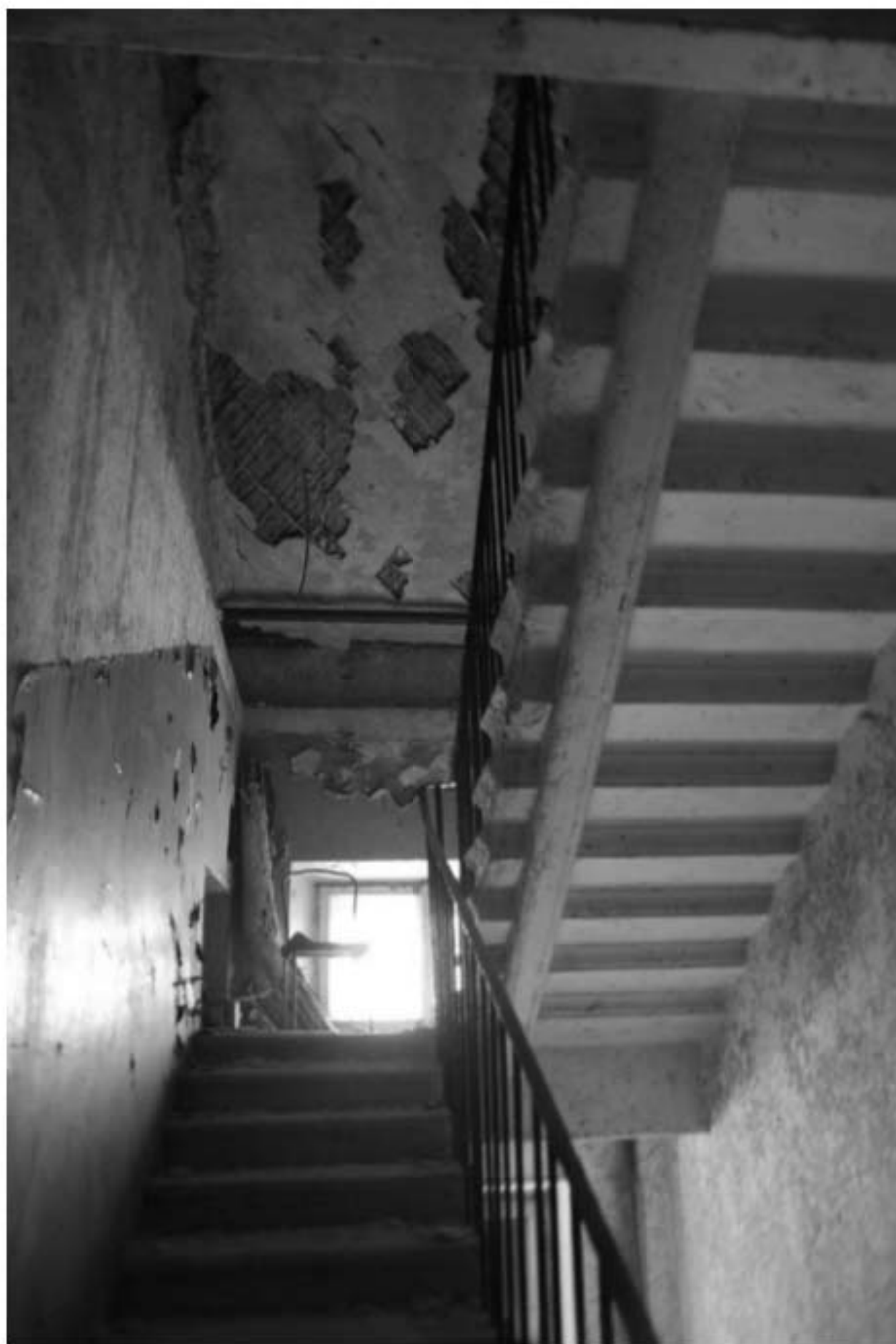
243. Лестница 4ЛК. Лестничная площадка между 5 этажом и чердаком.
