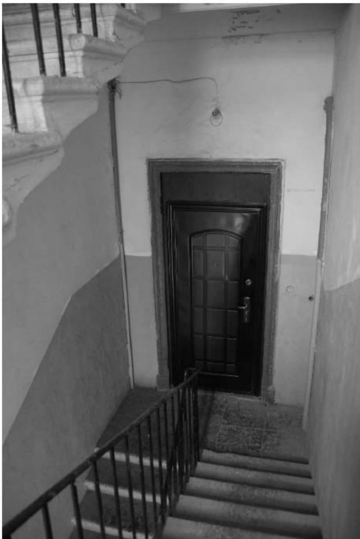
1175. Лестница 2ЛК. Вид на лестничную площадку 4 этажа.
