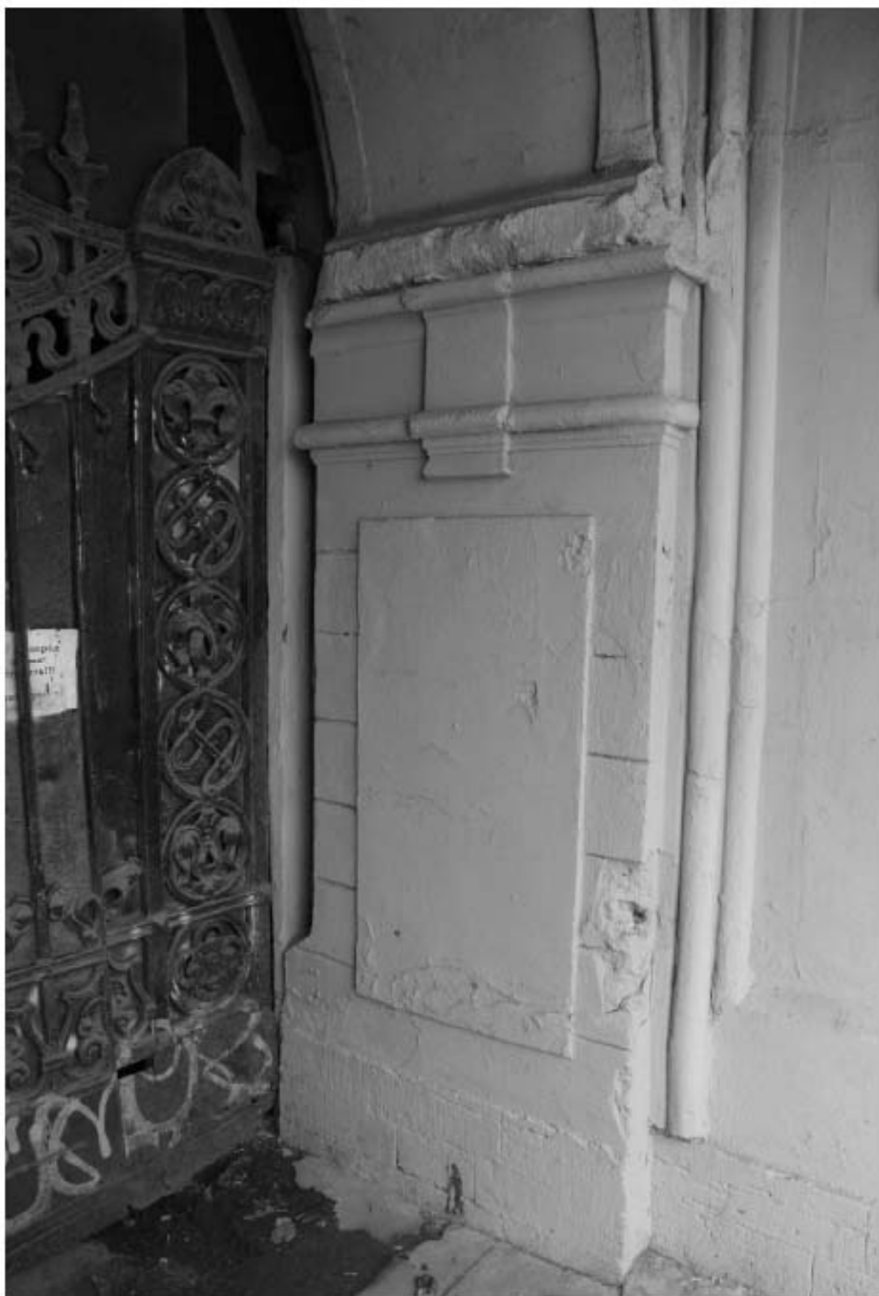
37. Фрагмент проездной арки.
