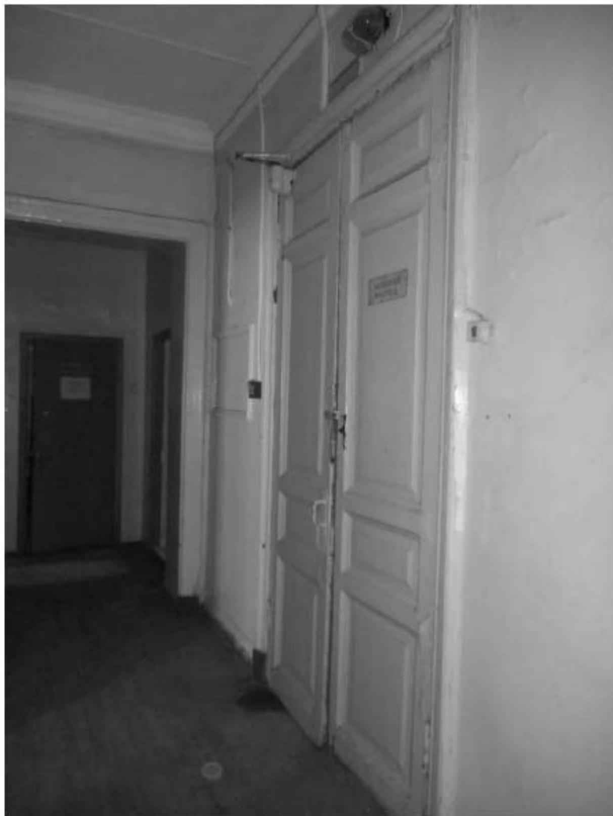
774. Этаж 4, помещение 40-Н. Дверь выхода на лестницу ЗЛК.
