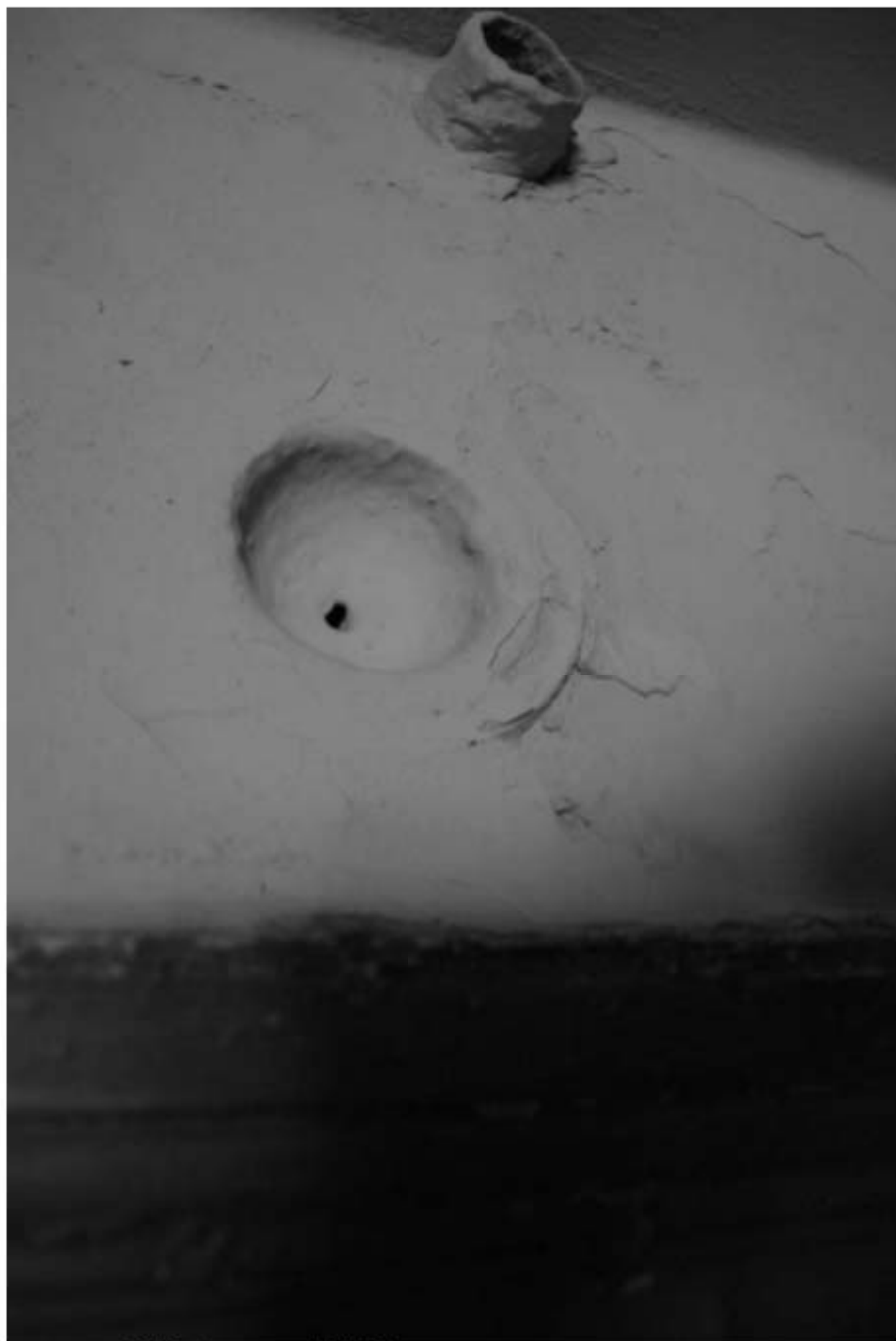
1276. Лестница 2ЛК. Вид на отверстие дверного звонка.
