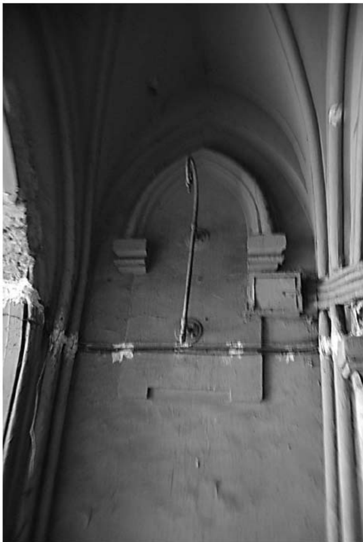
59. Воротный проезд лицевого корпуса. Фрагмент.
