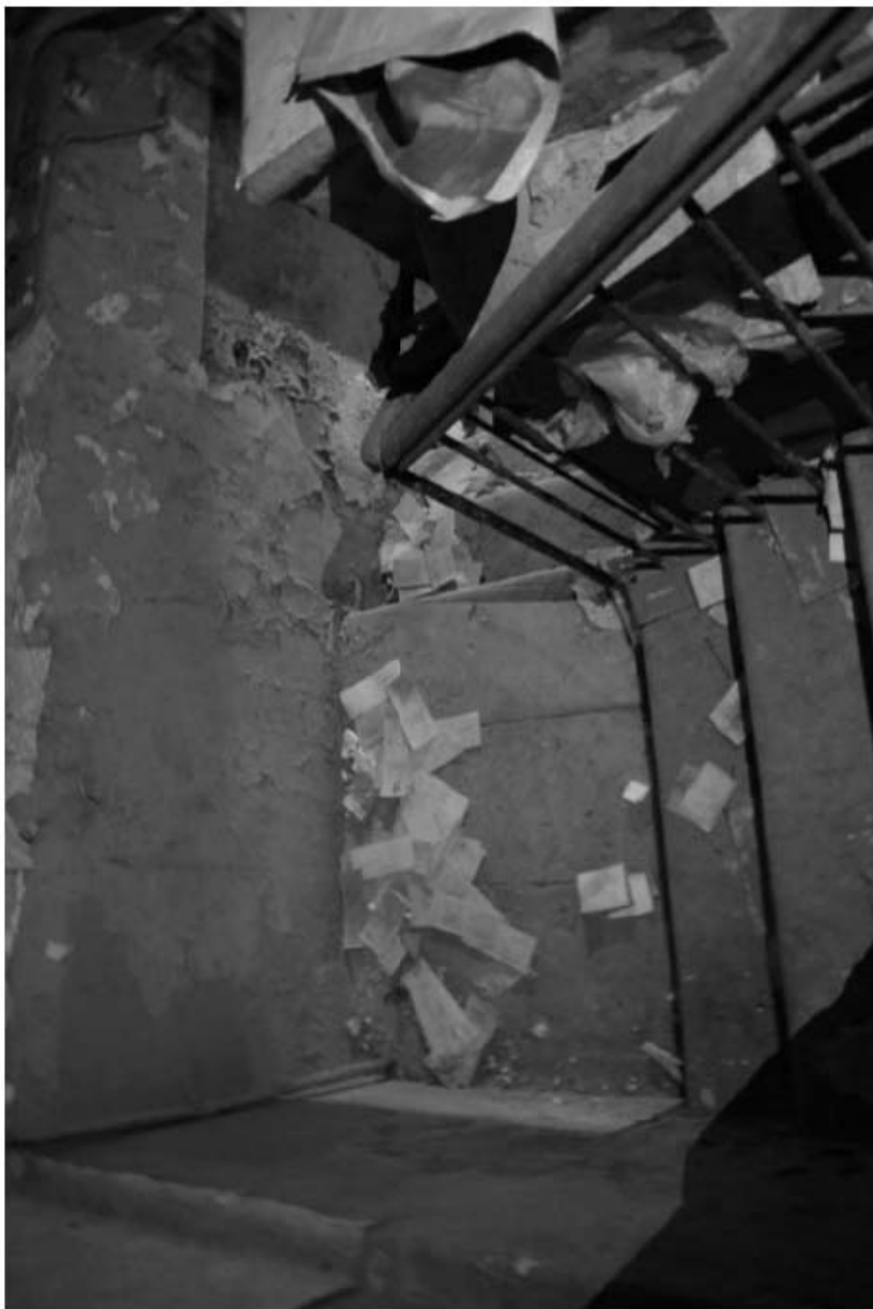
954. Подвал, помещение 6-Н. Интерьер лестницы на 1 этаж.
