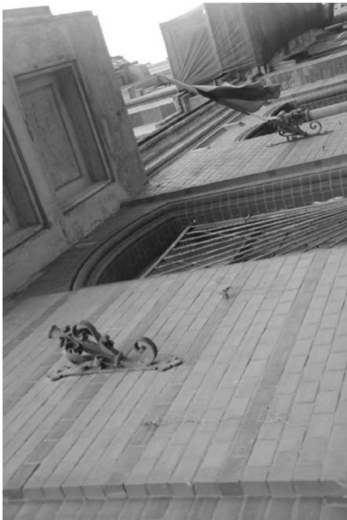
40. Вид на флагодержатели на лицевом фасаде.
