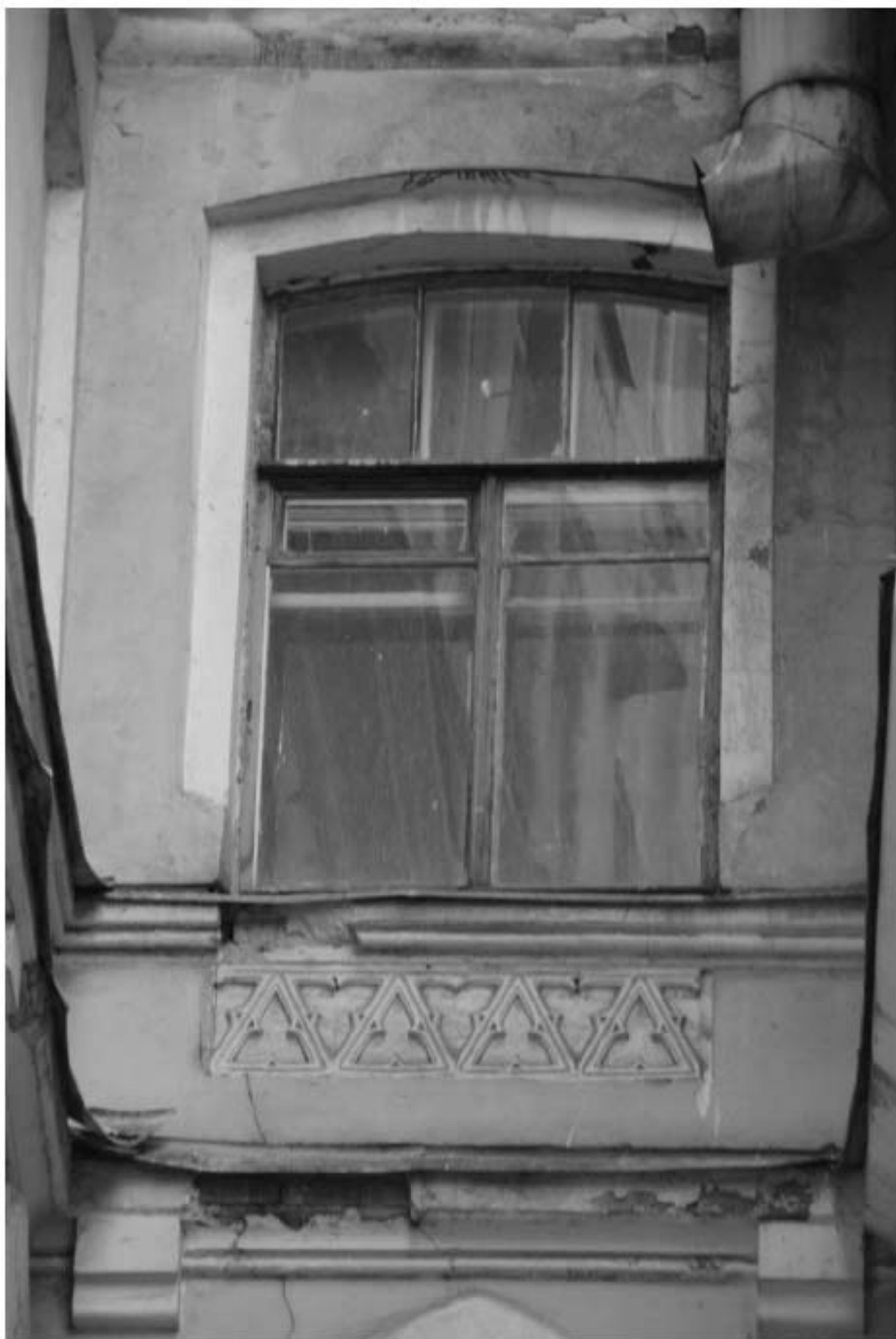
84. Фрагмент дворового фасада.
