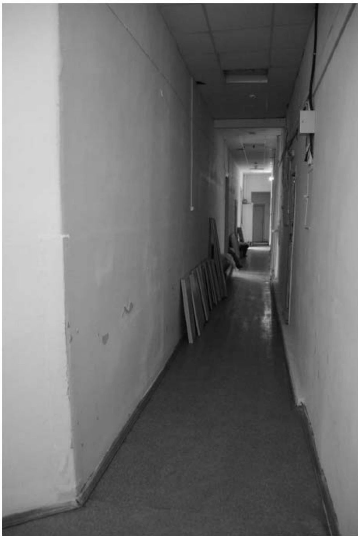
550. Этаж 2, помещение 16-Н. Вид коридора.
