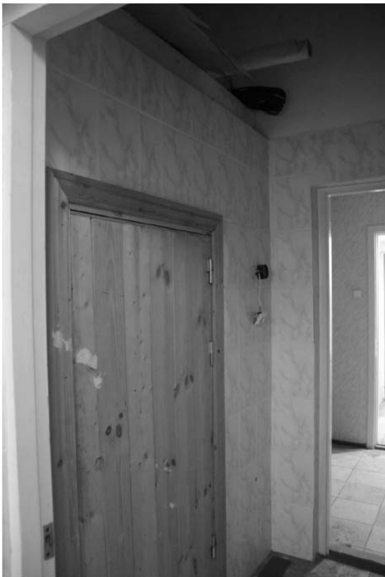
387. Этаж 1, помещение 15-Н. Интерьер душевой.
