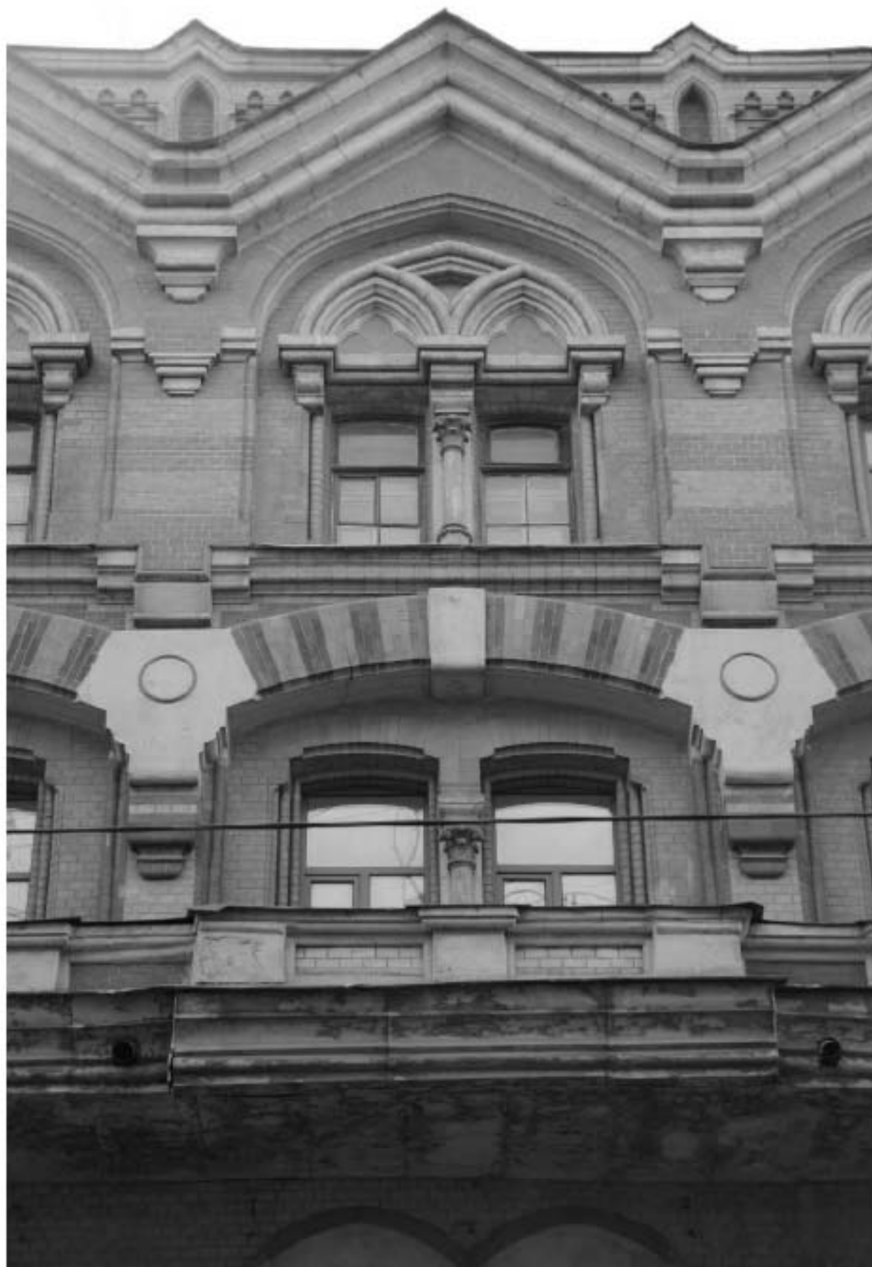
8. Фрагмент лицевого фасада.
