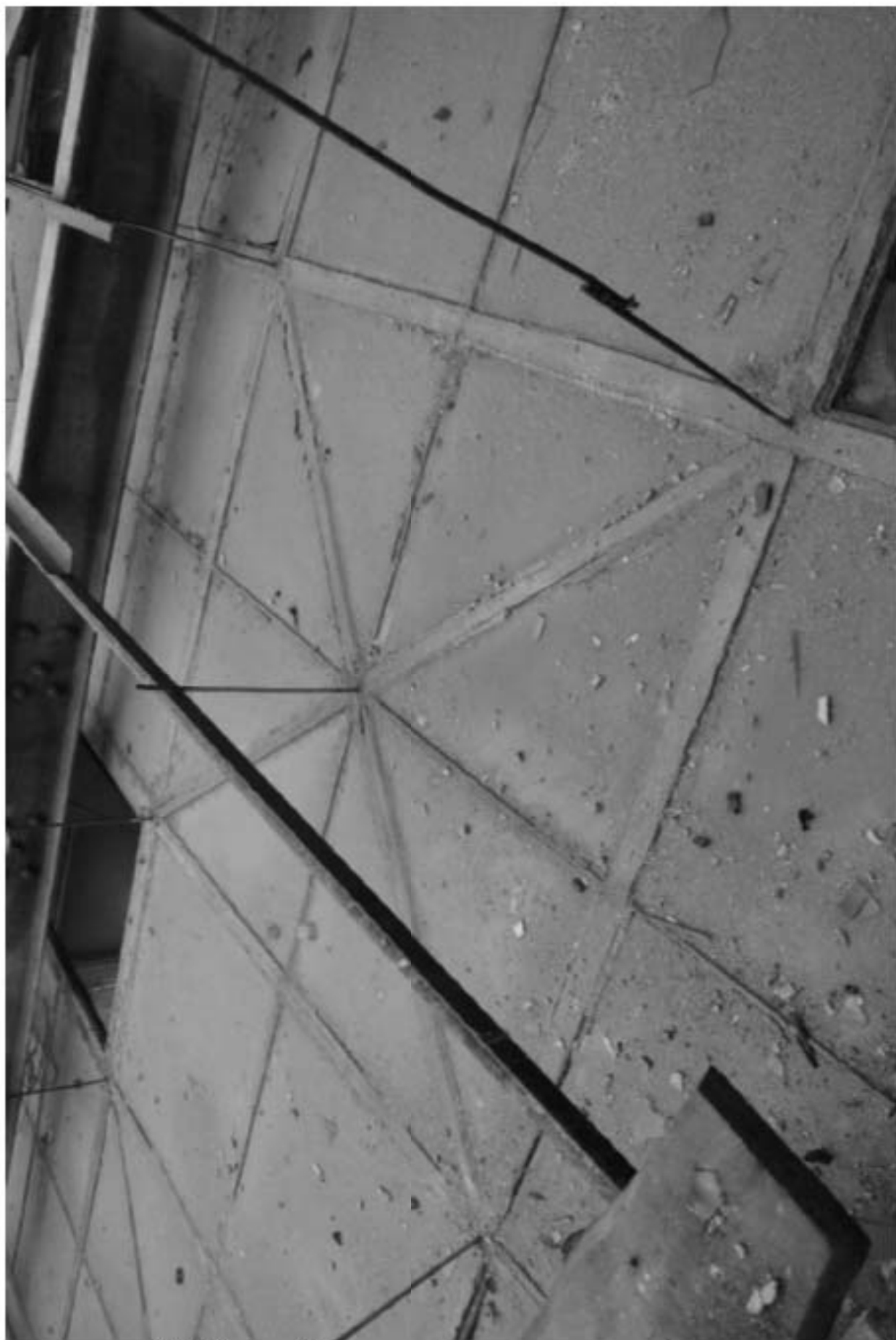
897. Чердак. Вид на конструкции светового фонаря.
