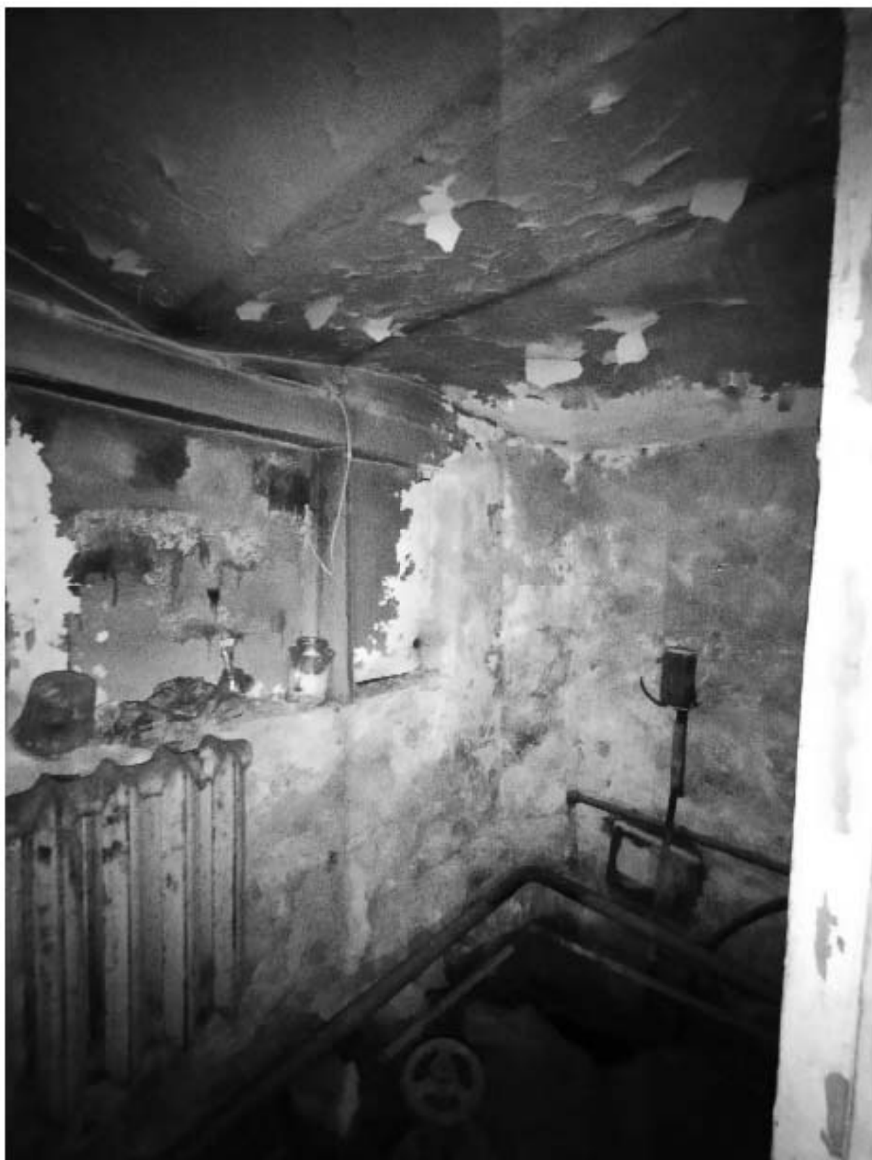
989. Подвал, помещение 6-Н. Интерьер комнаты 2,5 кв.м.
