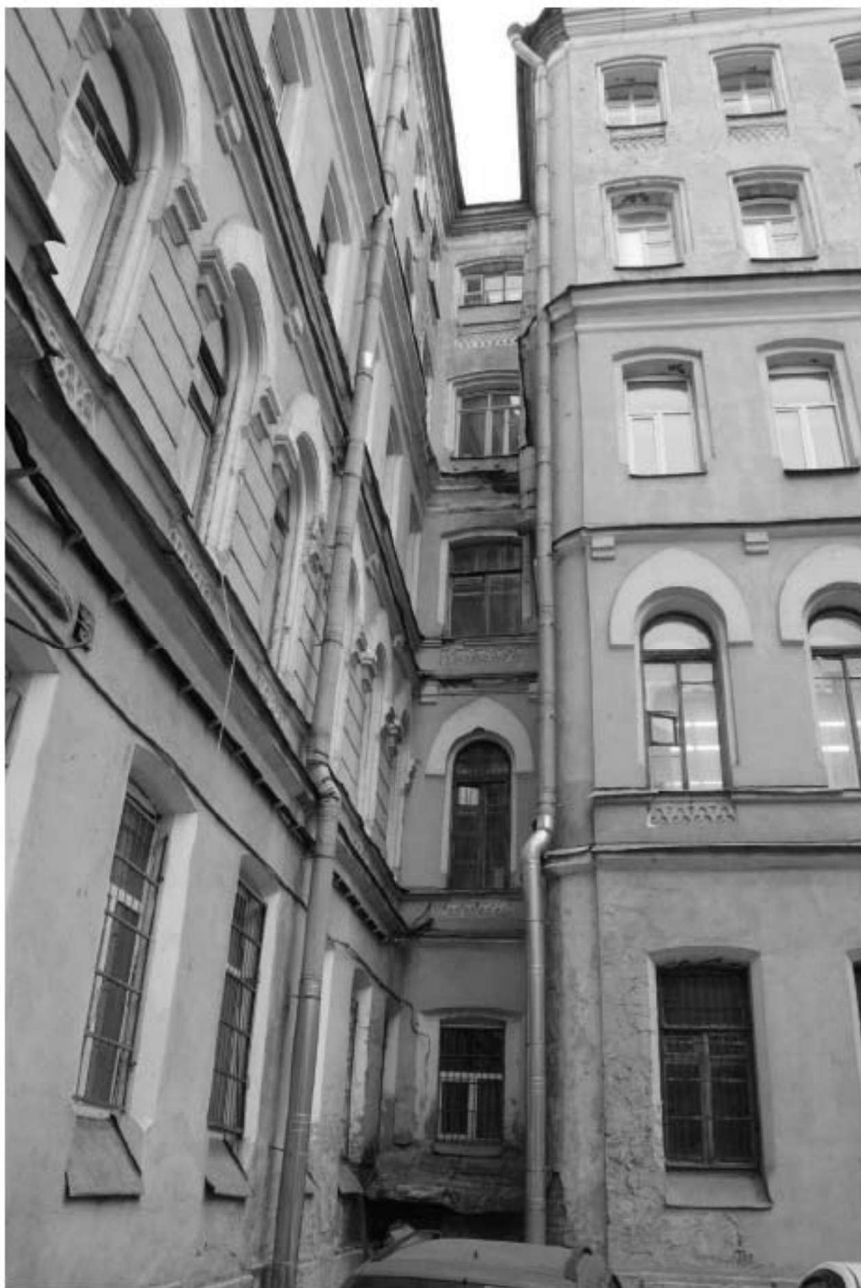
81. Фрагмент дворового фасада.
