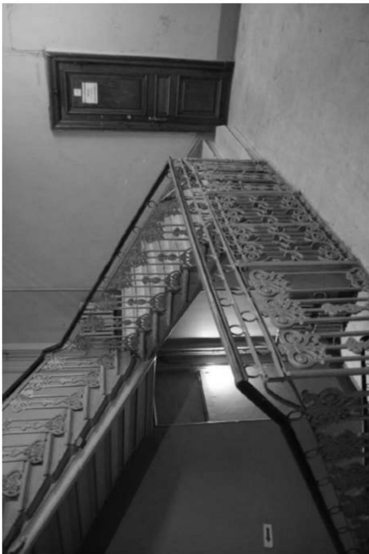
464. Этаж 2, входная дверь в помещение 30-Н.
