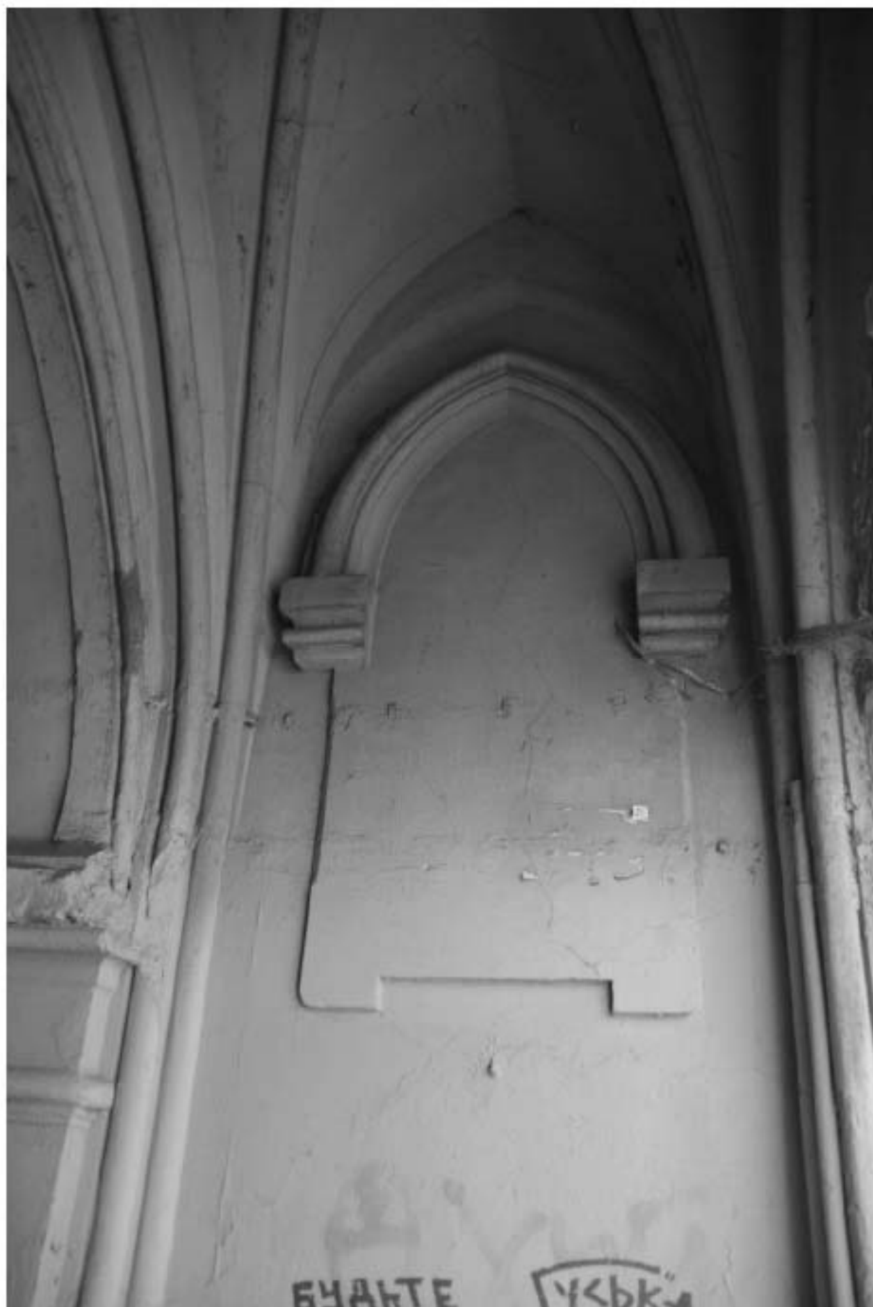
38. Фрагмент проездной арки.
