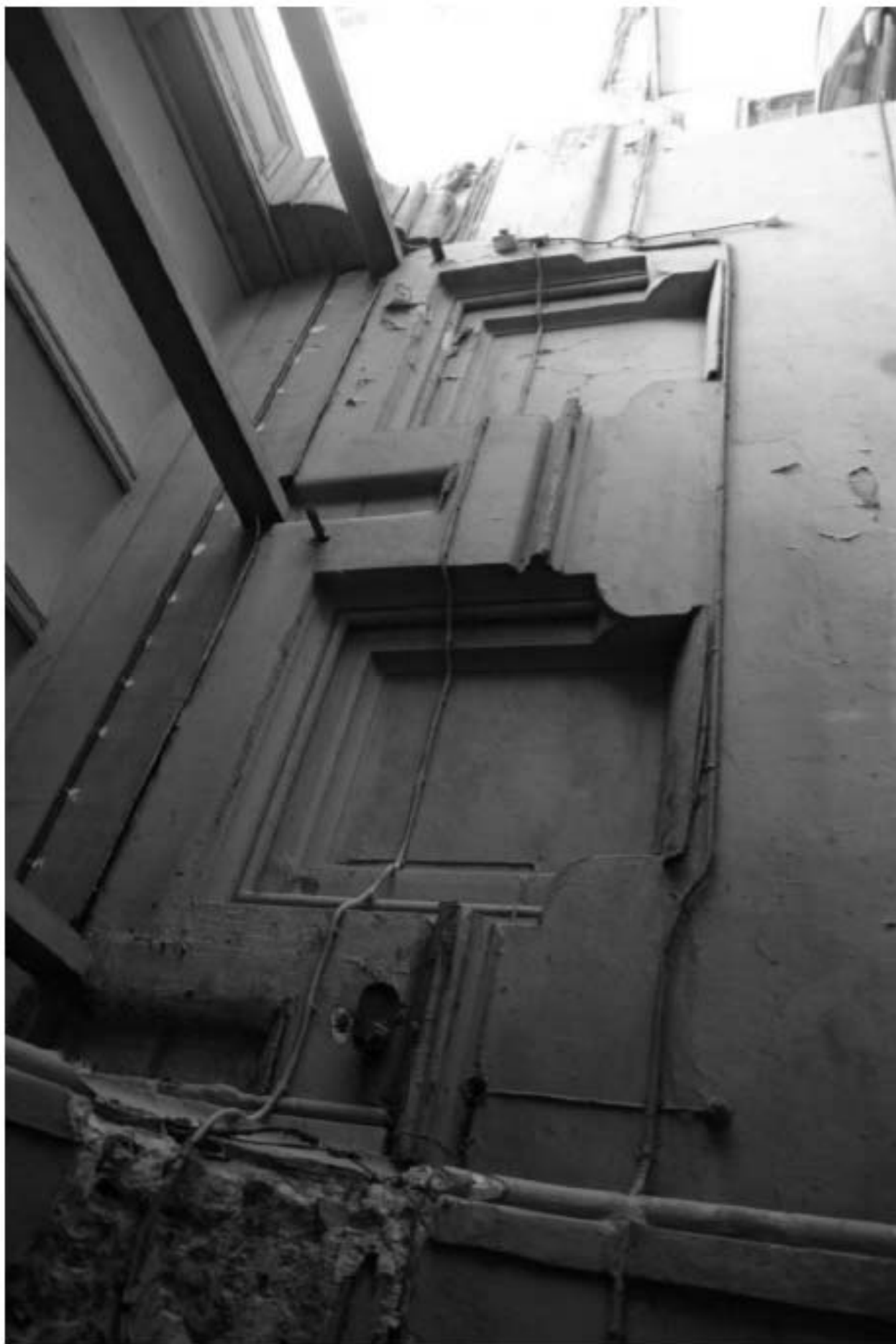
71. Воротный проезд лицевого корпуса. Фрагмент.
