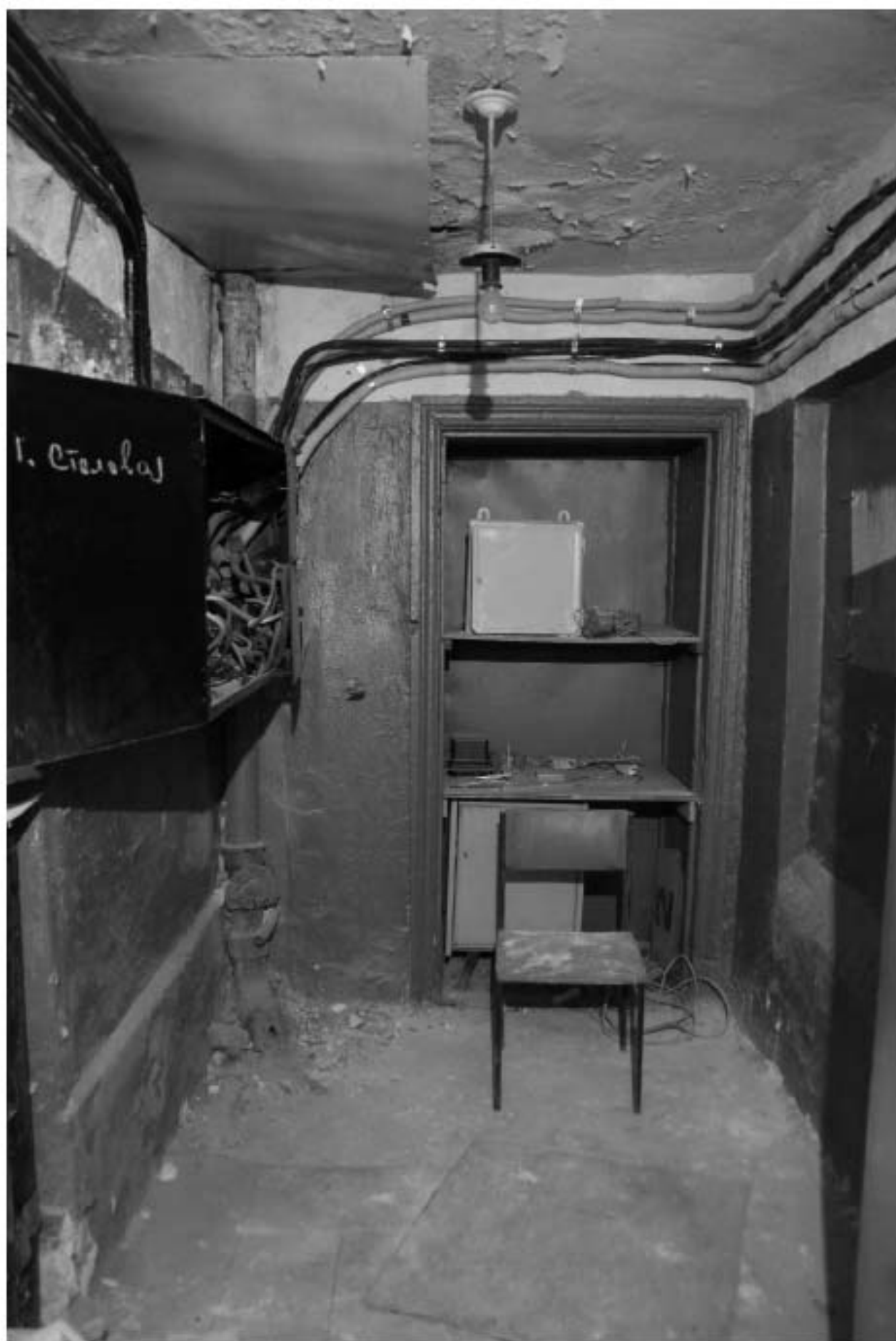
1011. Подвал, интерьер помещения 10-Н.
