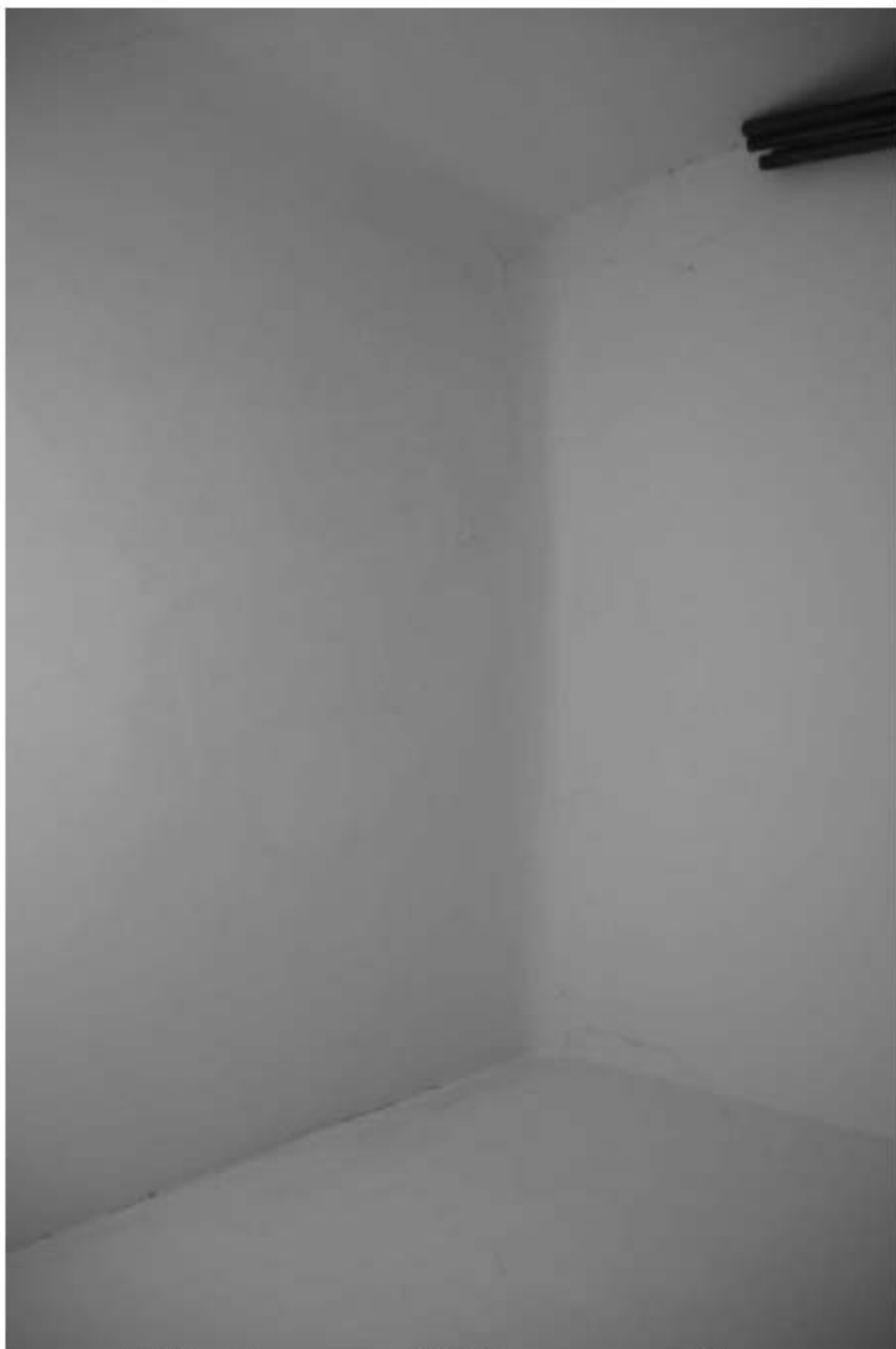
281. Этаж 1, помещение 20-Н. Потолок комнаты 4,7 кв.м.
