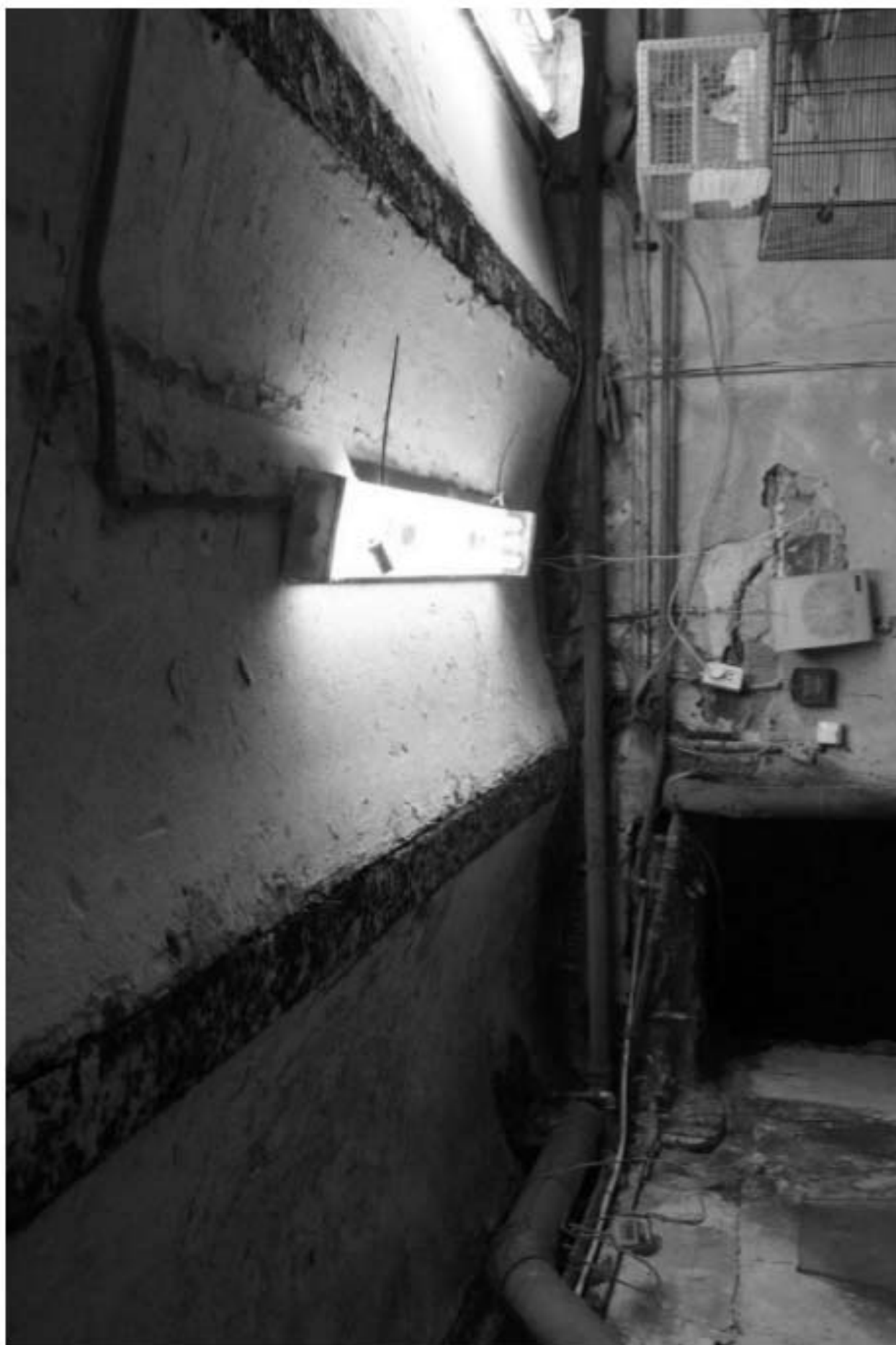
1028. Подвал, помещение 2-Н. Интерьер комнаты 27,9 кв.м.
