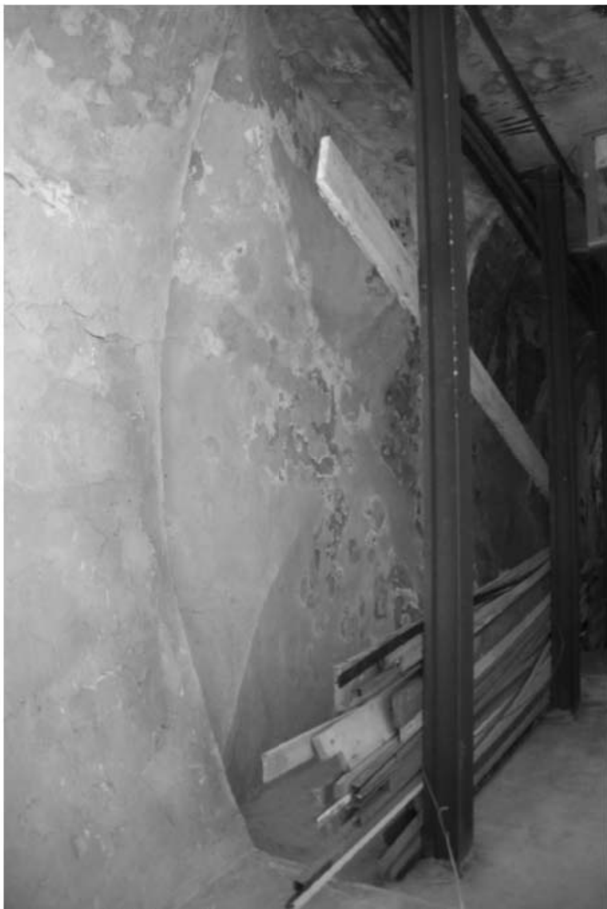
100. Воротный проезд дворового корпуса. Фрагмент.
