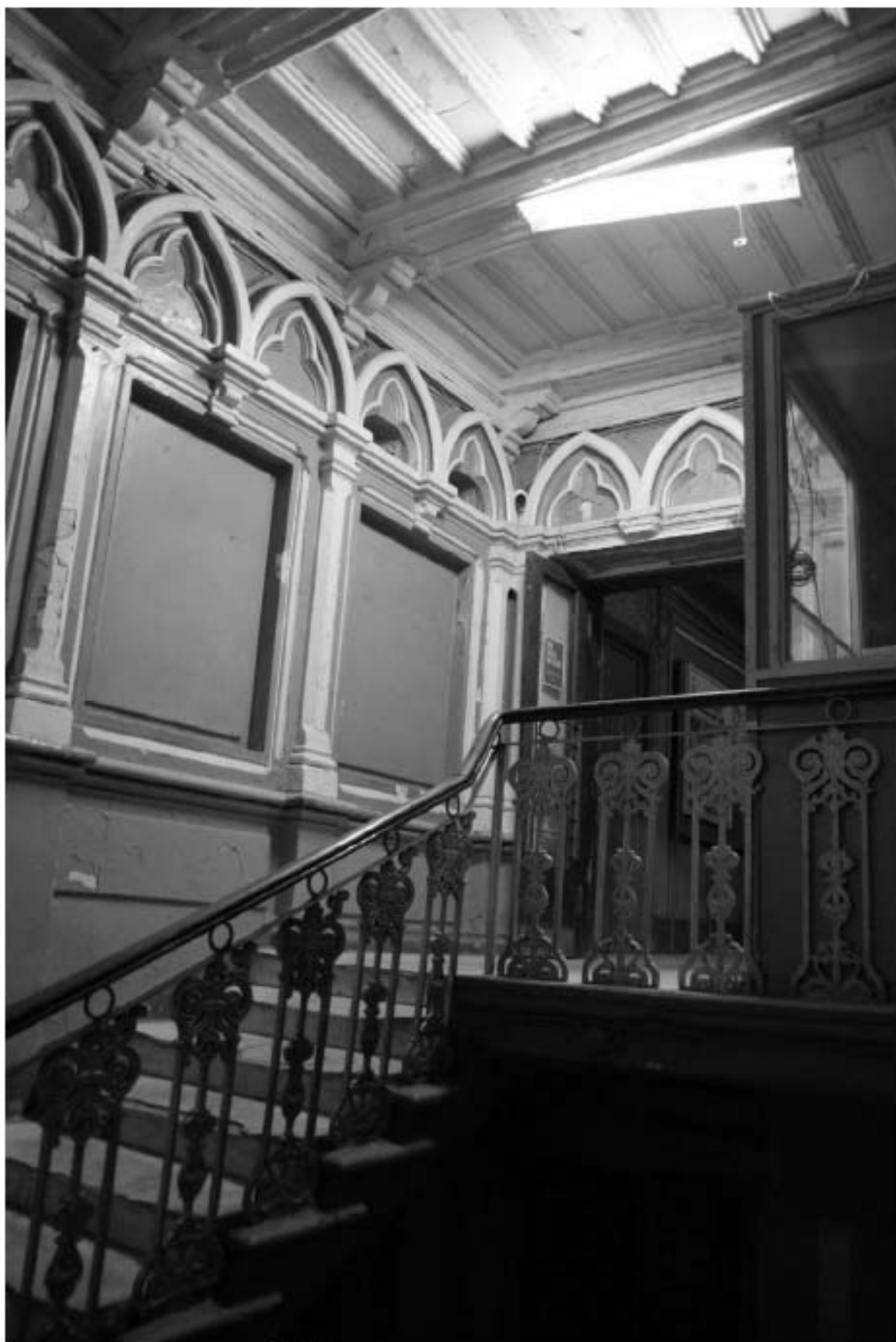
116. Вид на лестничную клетку.
