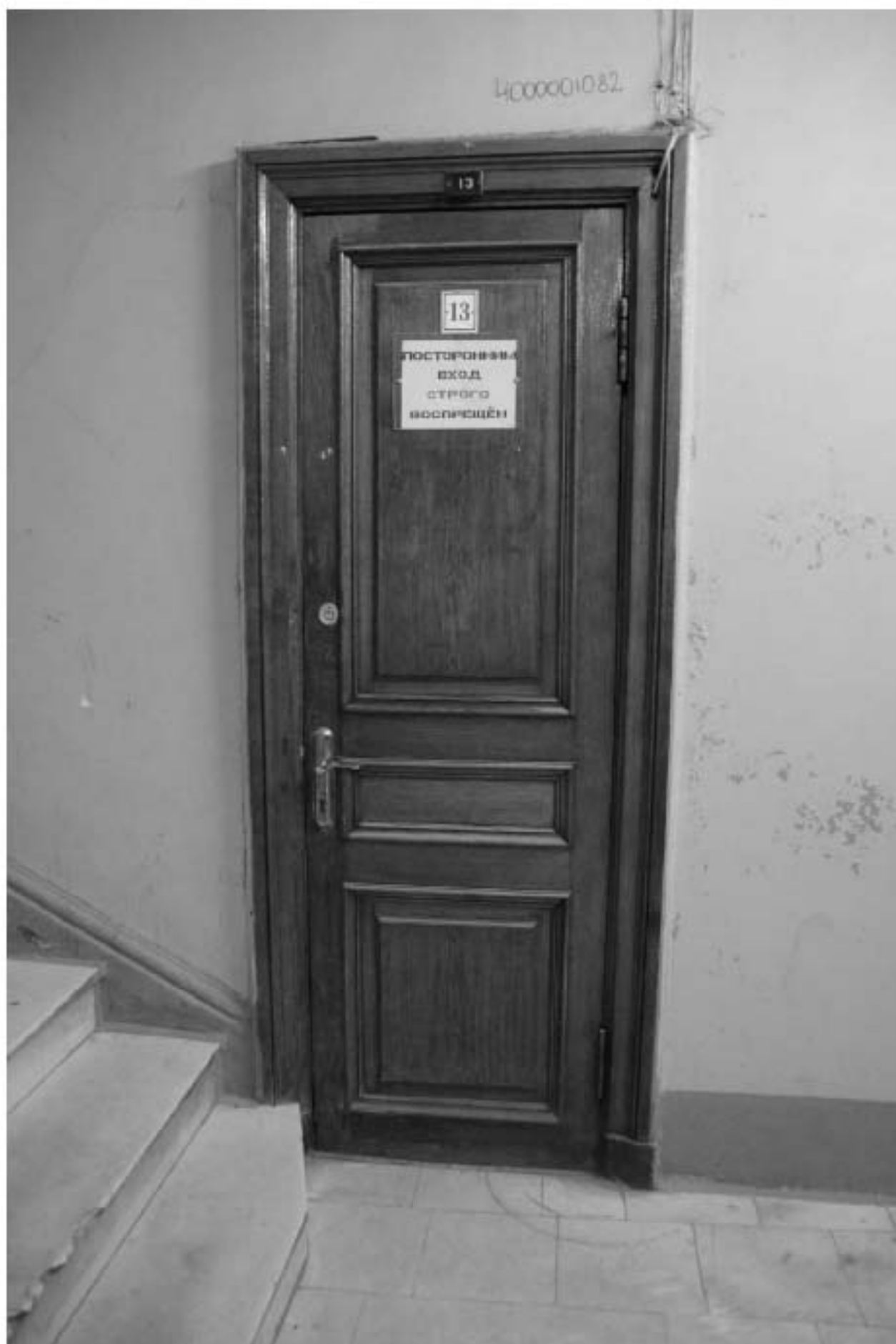
134. Входная дверь в помещения 2 этажа.
