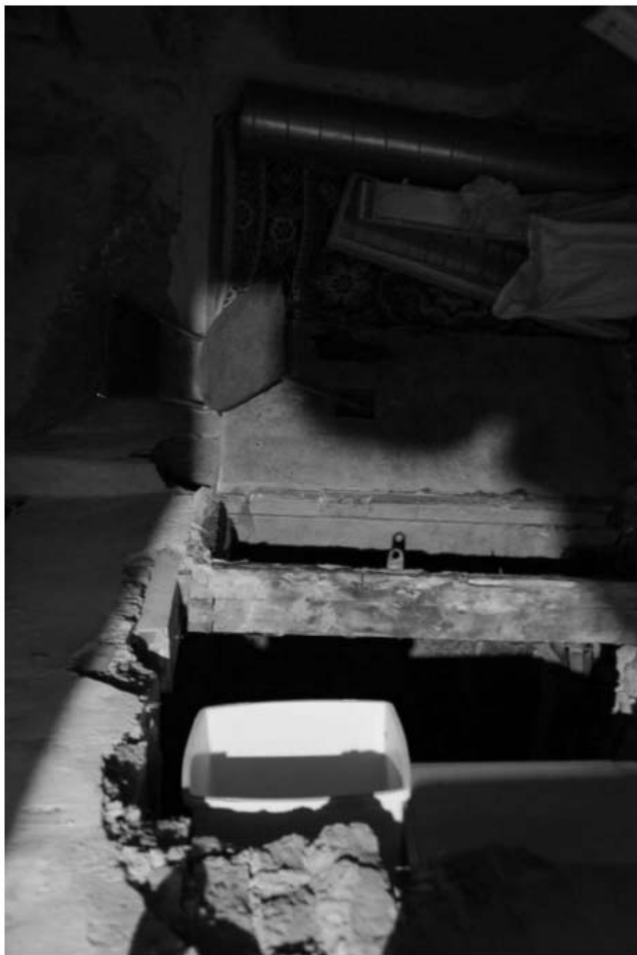
1024. Подвал. Интерьер помещения 5-Н.
