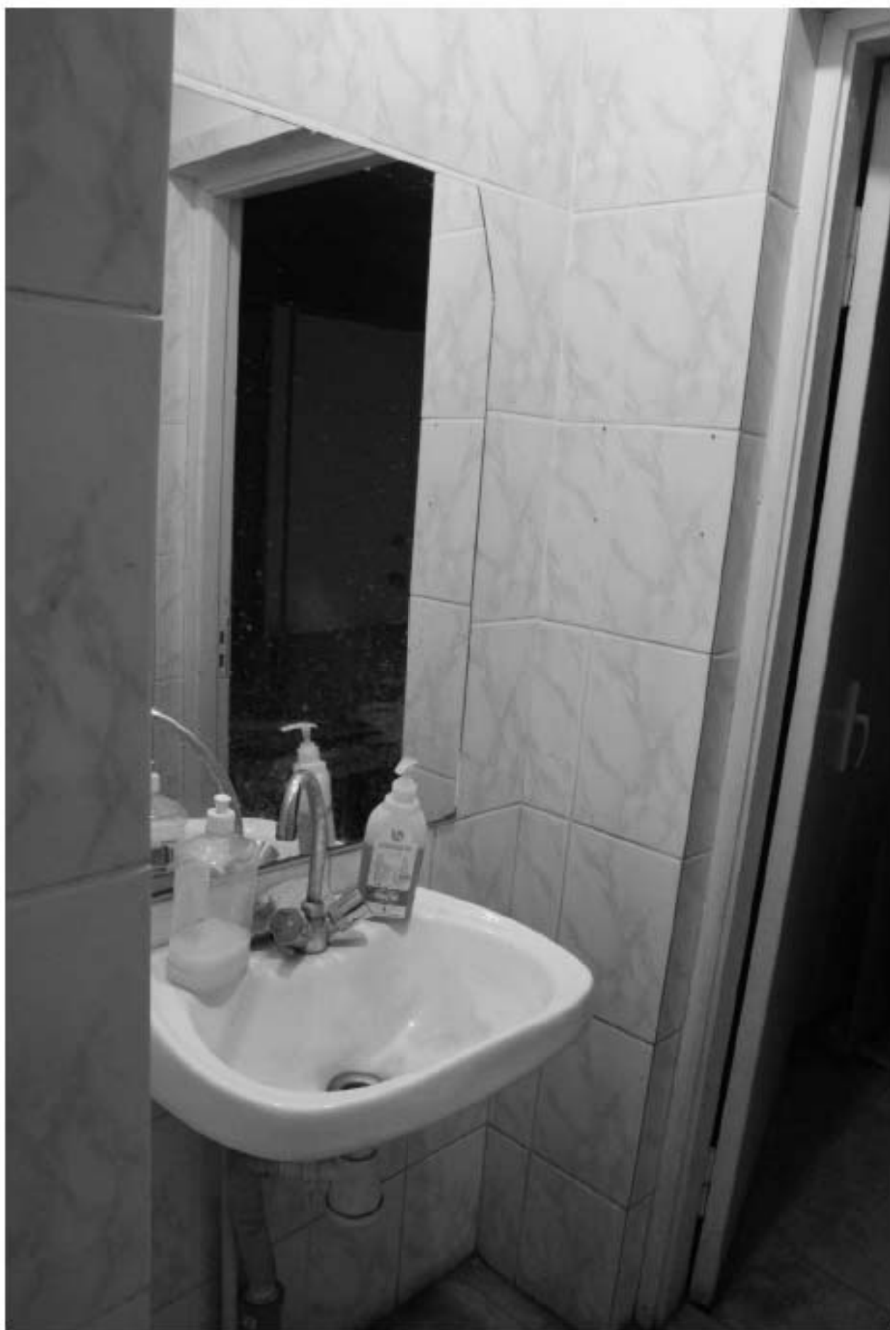
380. Этаж 1, помещение 15-Н. Интерьер душевой.
