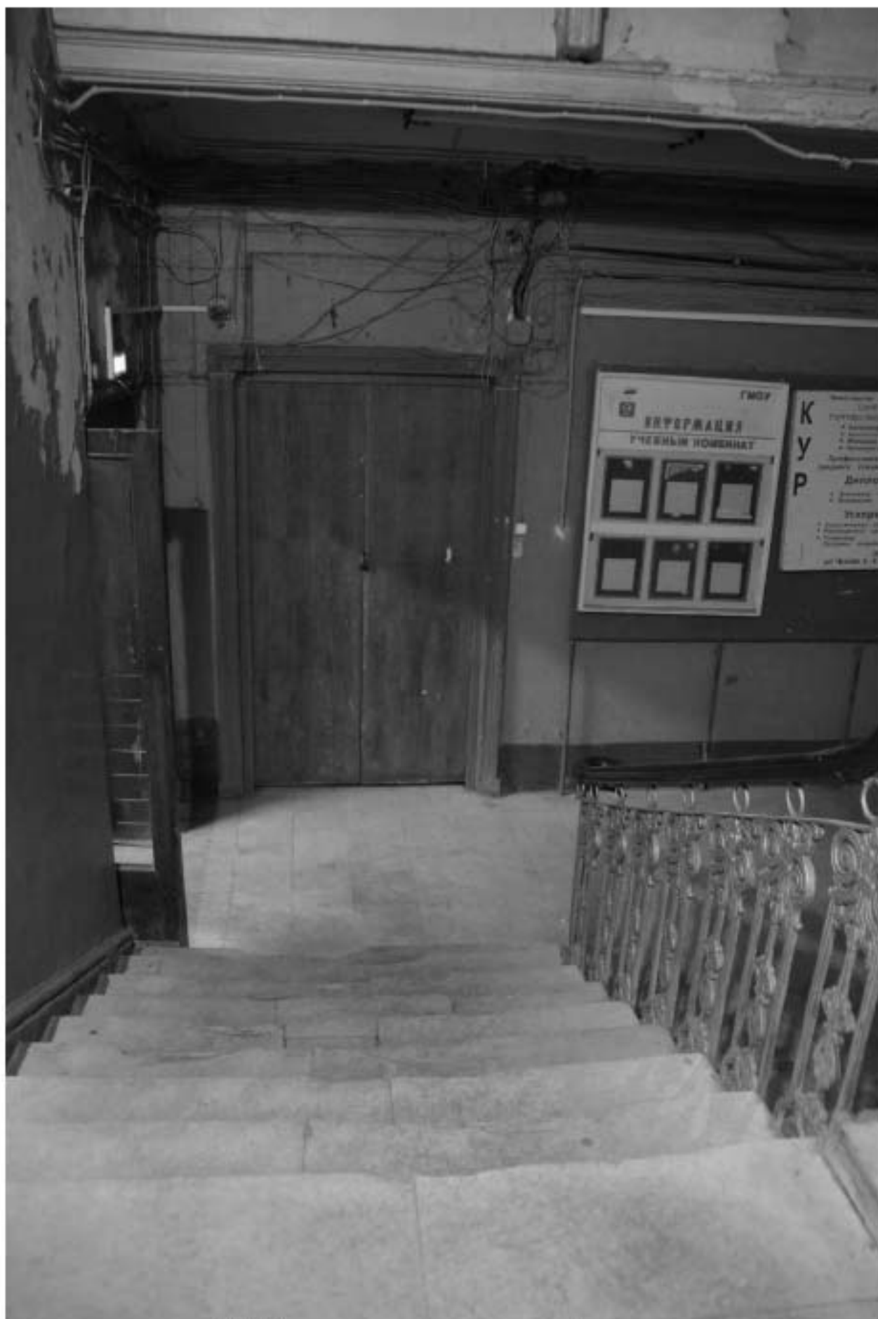
126. Вид на дверь в помещения 1 этажа.
