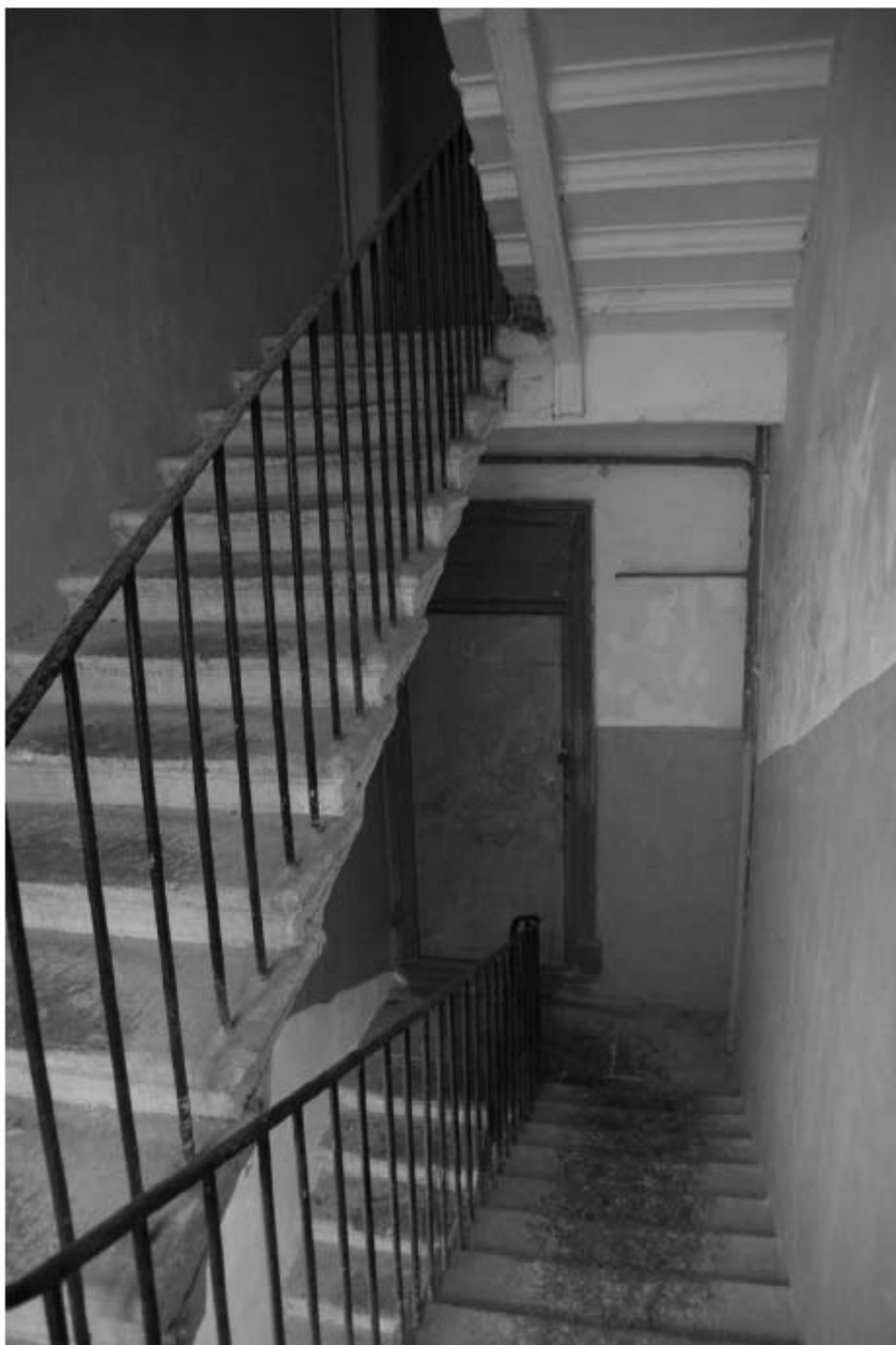
164. Лестница 2ЛК. Вид на лестничную площадку 1 этажа.
