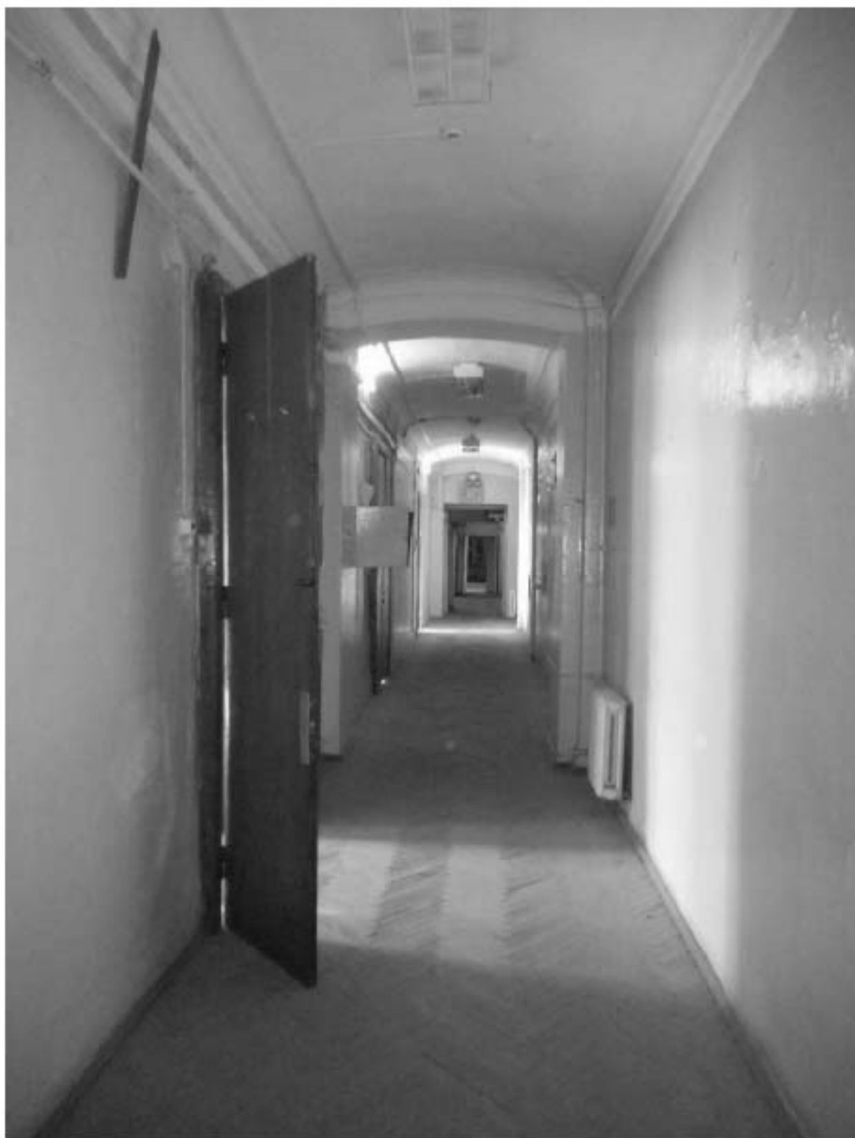
641. Этаж 3, помещение 17-Н. Вид коридора.
