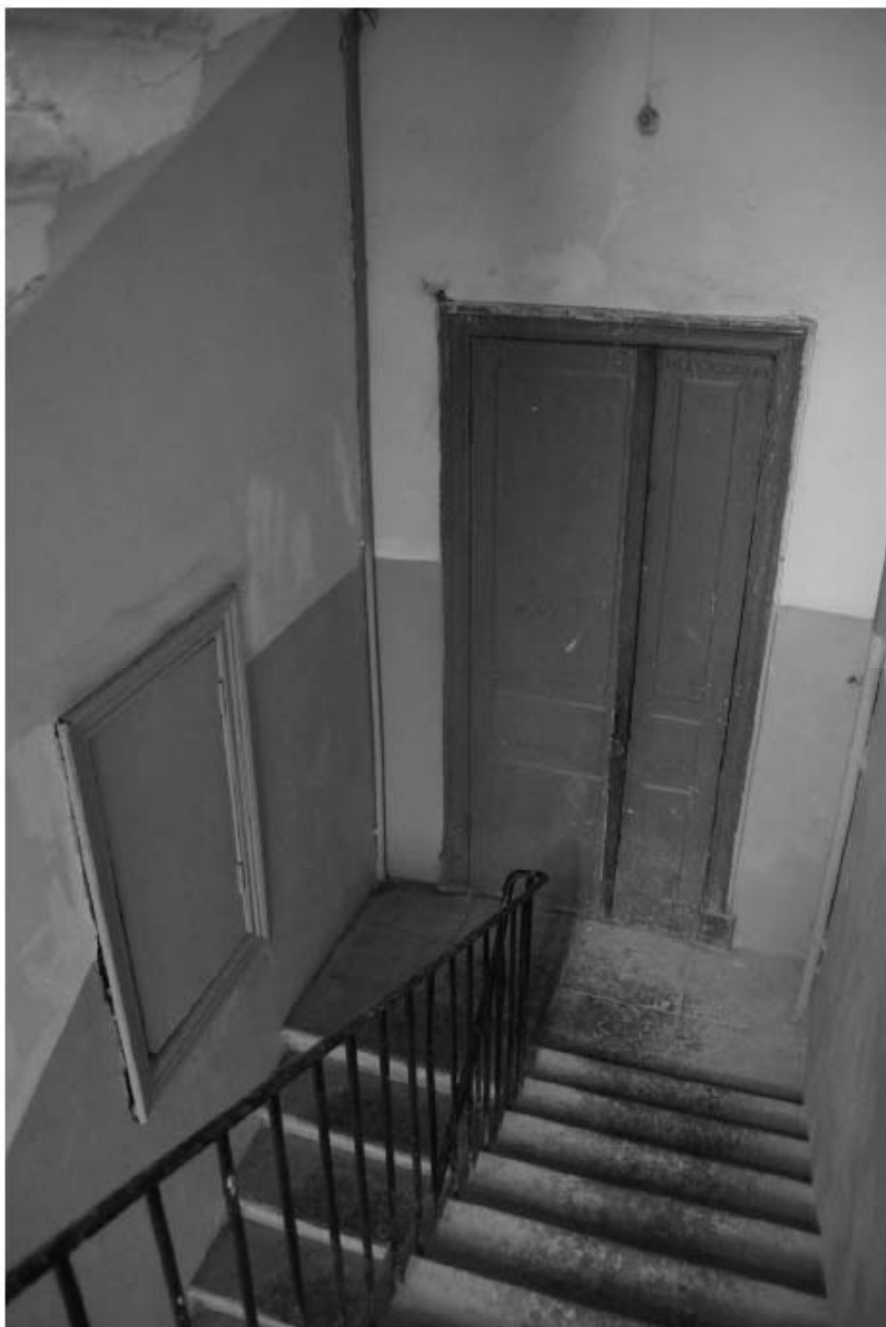
771. Лестница 2ЛК. Вид на лестничную площадку третьего этажа.
