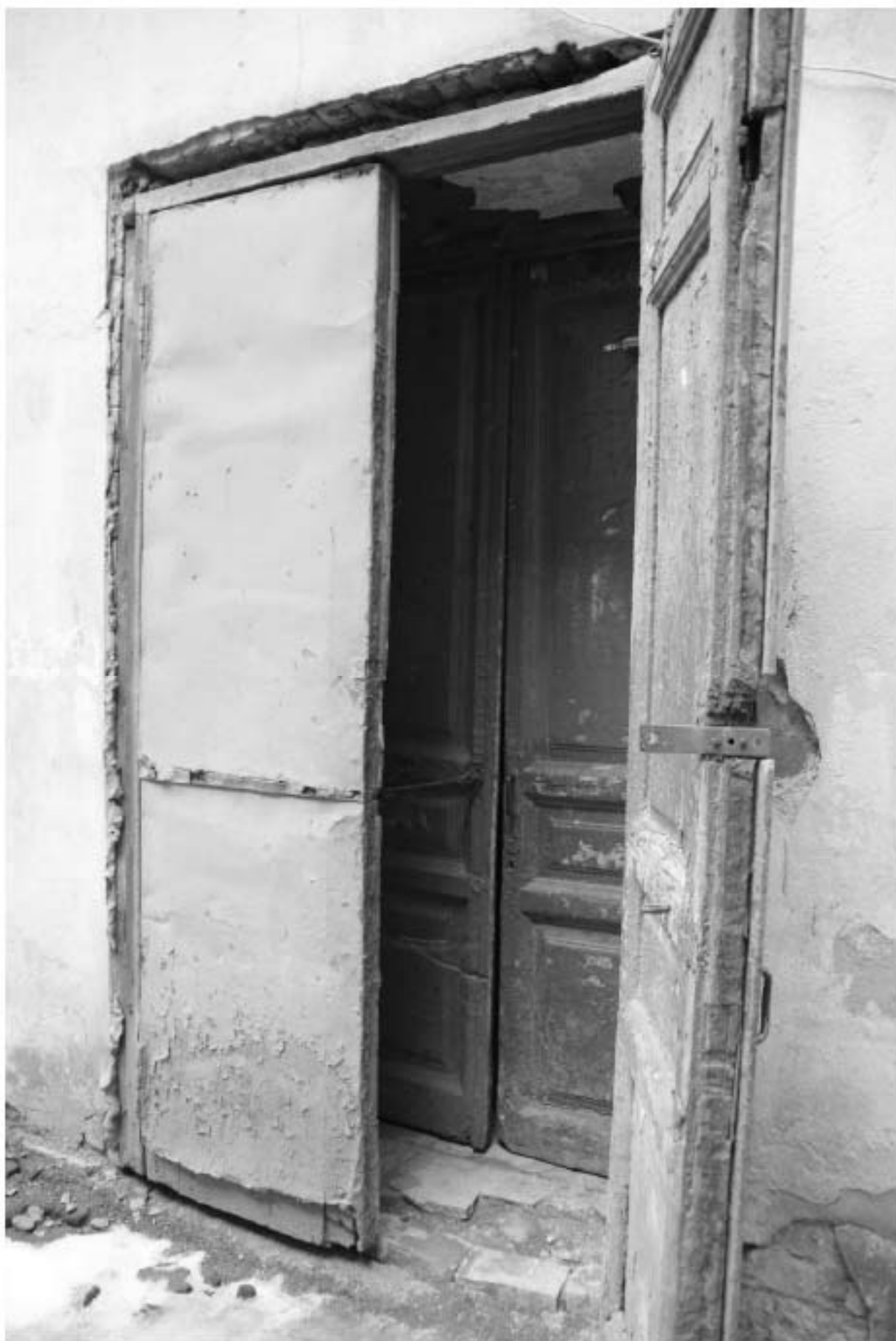
111. Вид на входную дверь лестницы ЗЛК.
