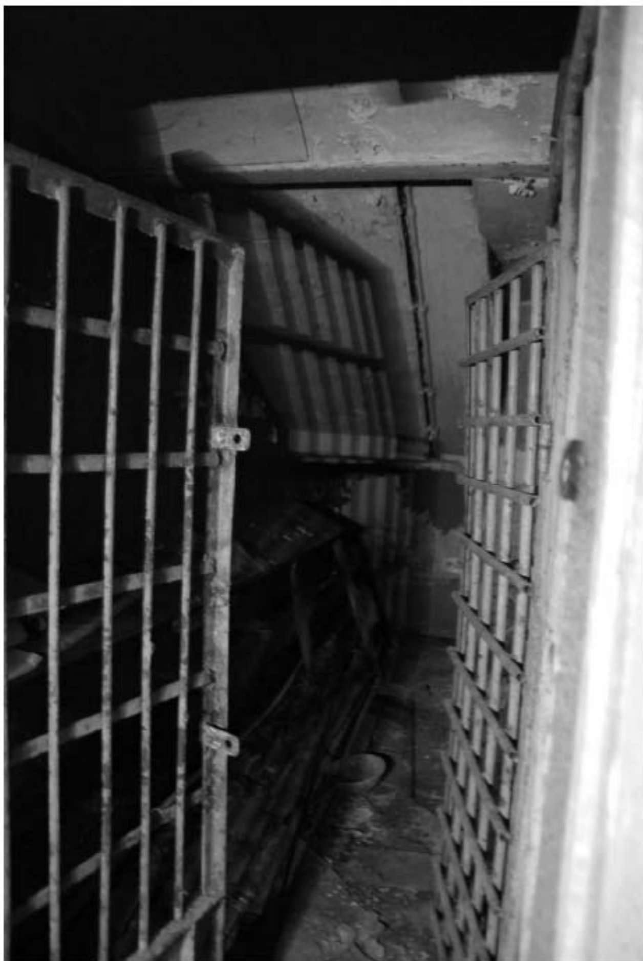
948. Подвал. Помещение 29-Н. Интерьер пространства под лестницей.
