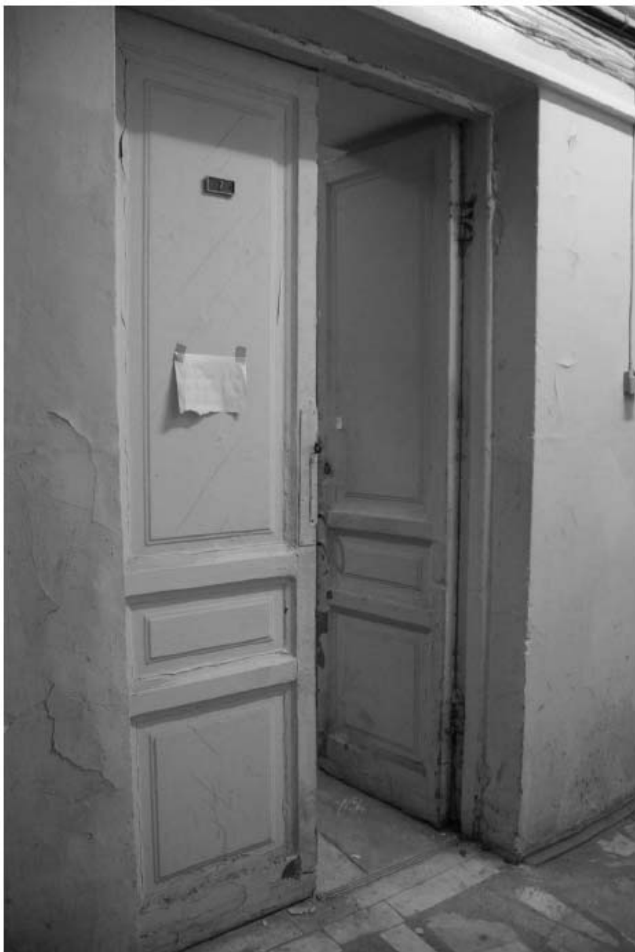
306. Этаж 1, помещение 15-Н. Дверь в комнату 24,8 кв.м.
