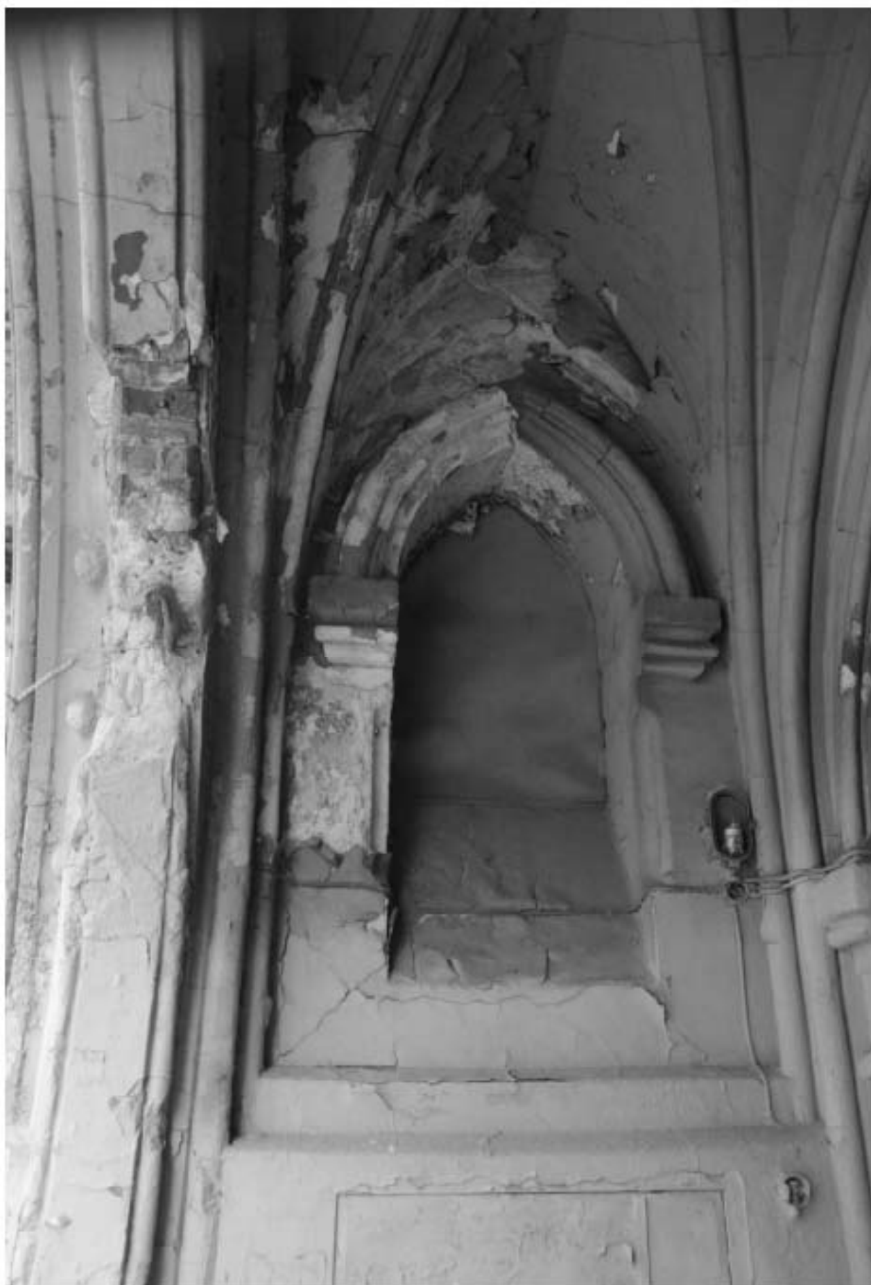
35. Фрагмент проездной арки.
