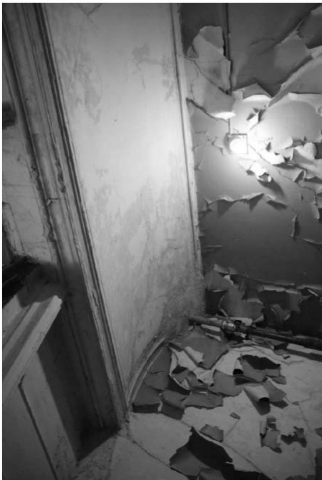
1395. Лестница 3ЛК. Своды лестничной площадки 2 этажа.
