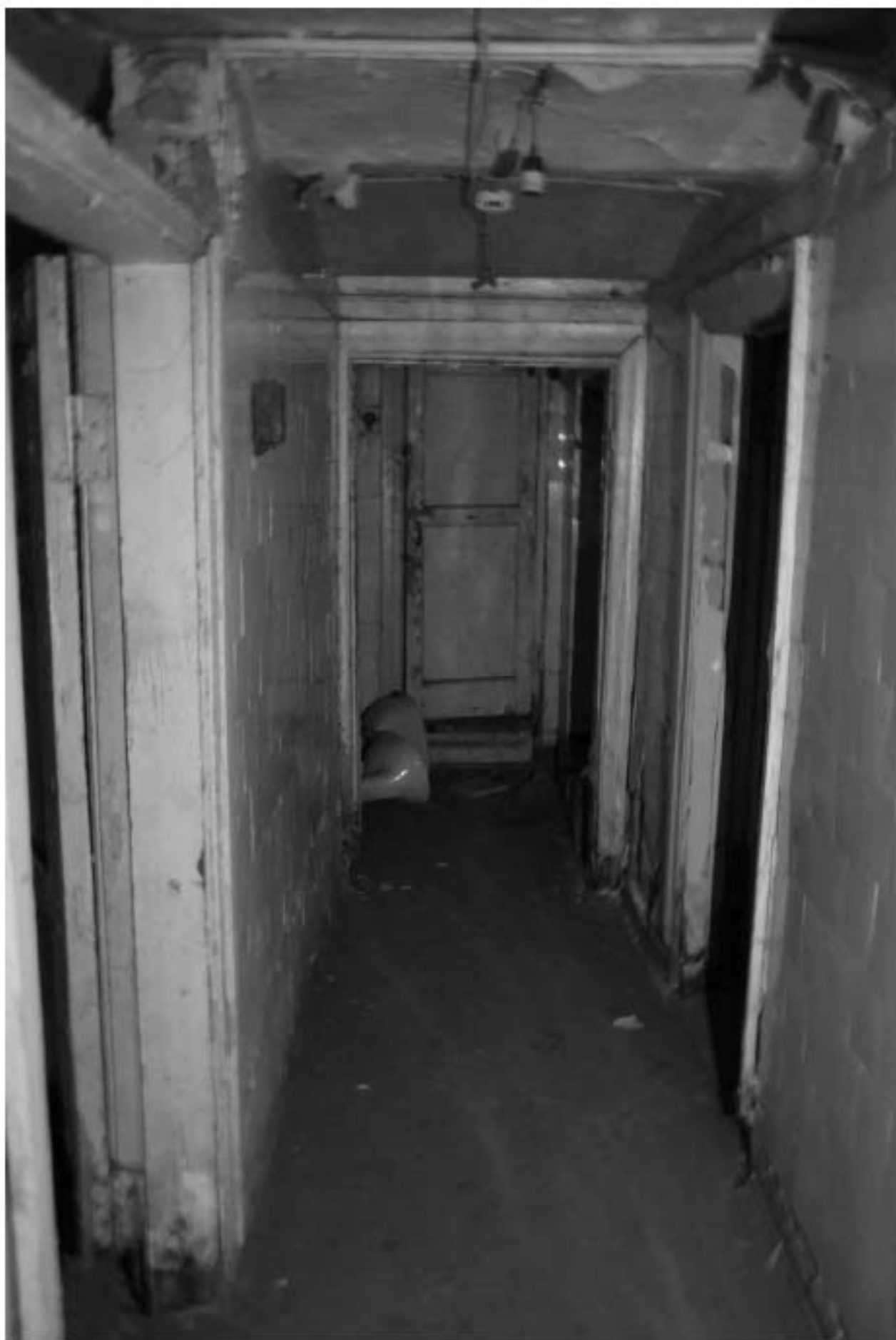
979. Подвал, помещение 6-Н. Вид коридора.
