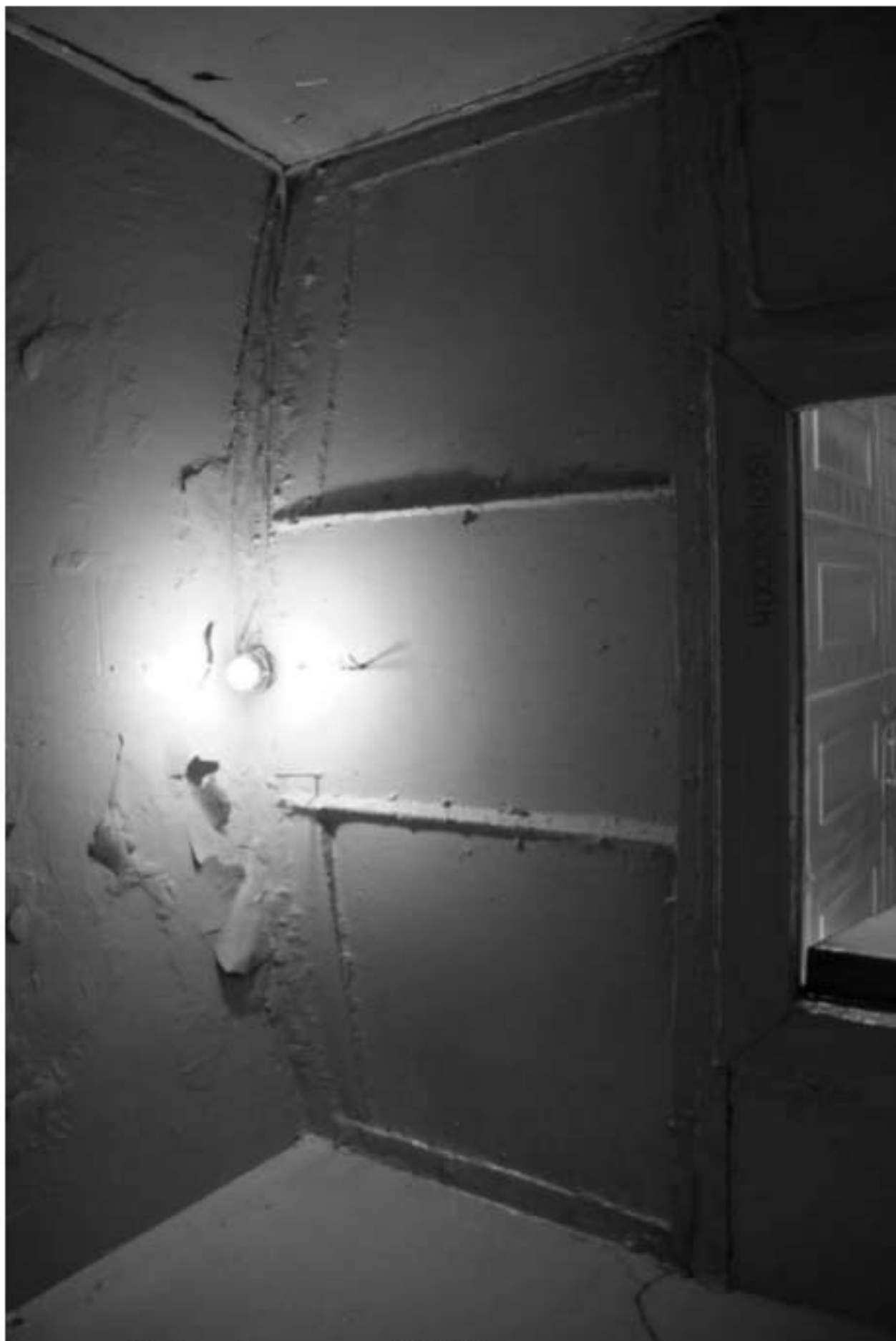
23. Этаж 1, помещение 20-Н. Интерьер входной группы.
