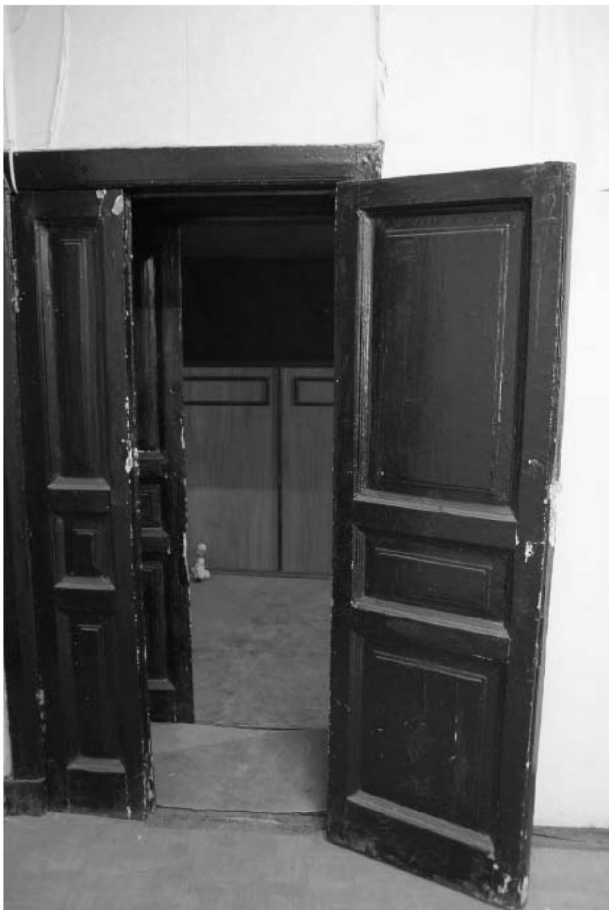
798. Этаж 5, помещение 31-Н. Вход в комнату 16,0 кв.м.
