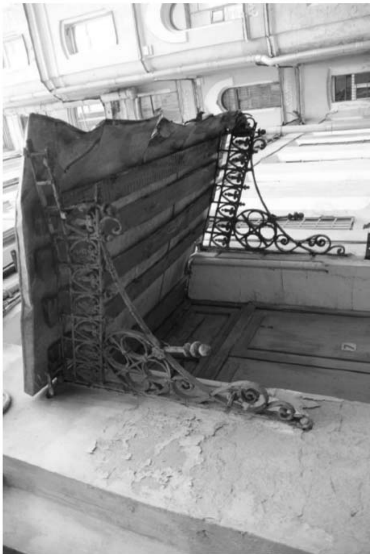
92. Дворовый фасад. Вид на козырёк.
