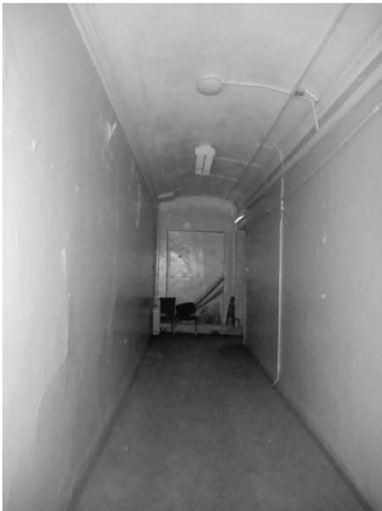
639. Этаж 3, помещение 17-Н. Вид коридора.
