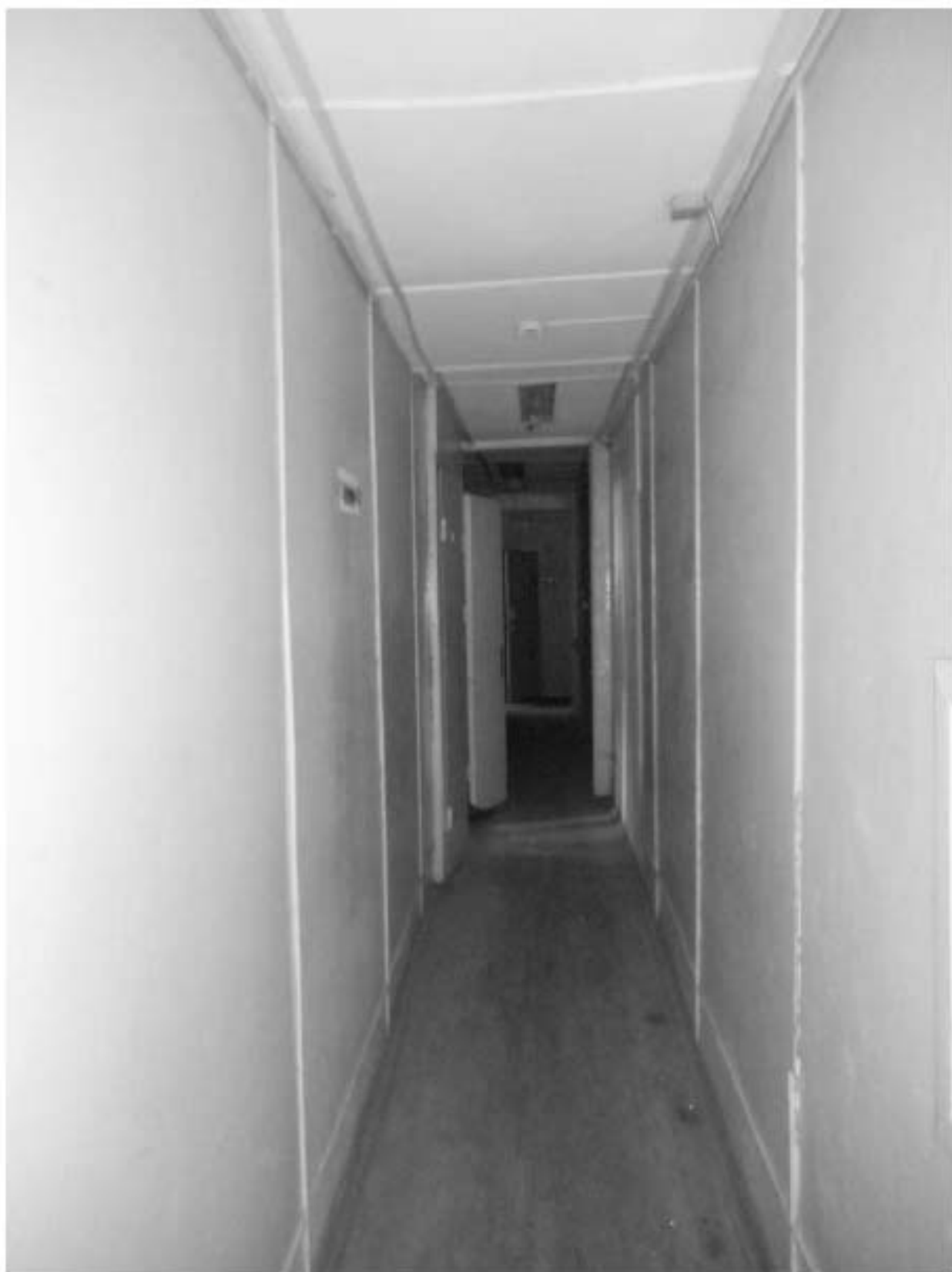
690. Этаж 3, помещение 17-Н. Вид коридора.
