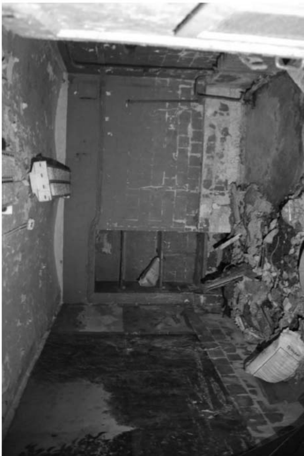
965. Подвал, помещение 6-Н. Интерьер комнаты 12,1 кв.м.
