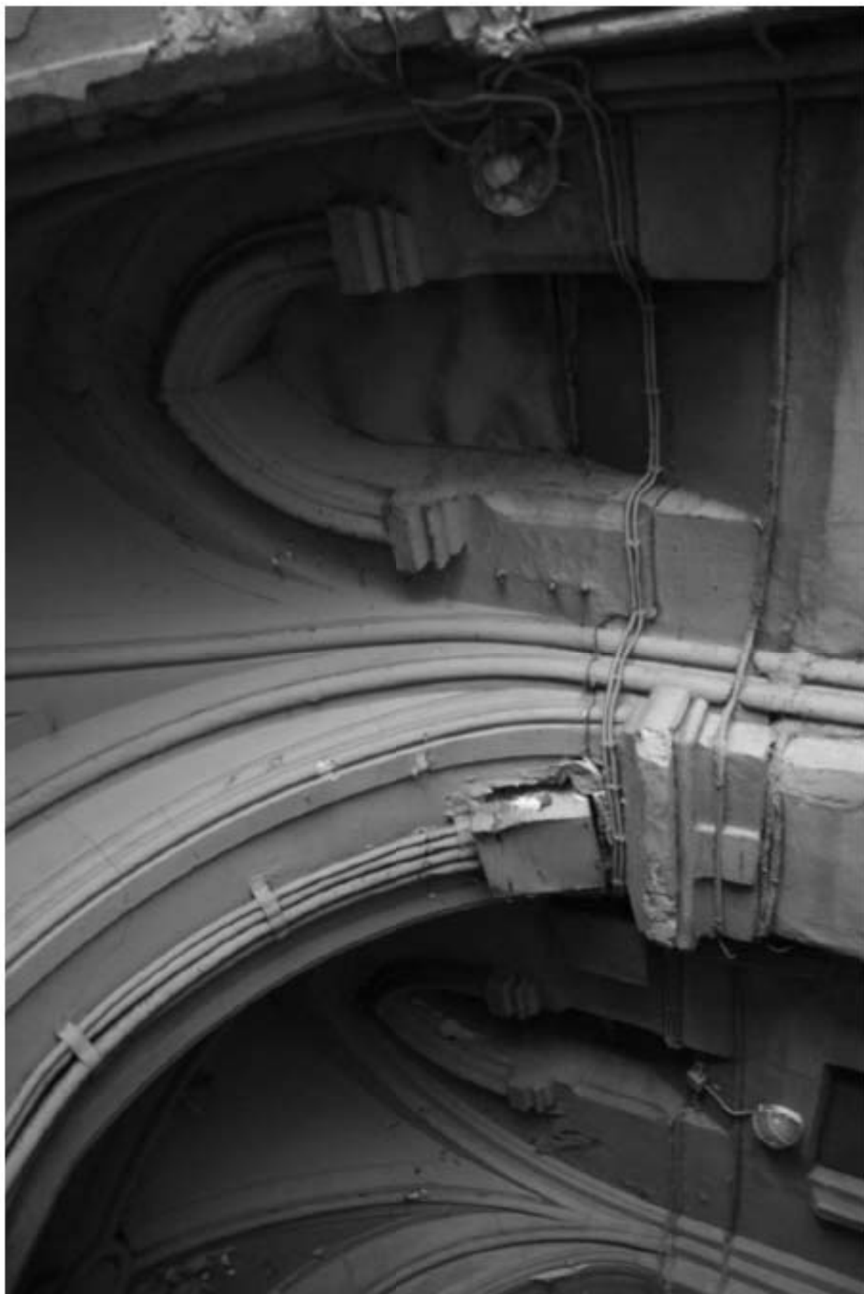
70. Воротный проезд лицевого корпуса. Фрагмент.
