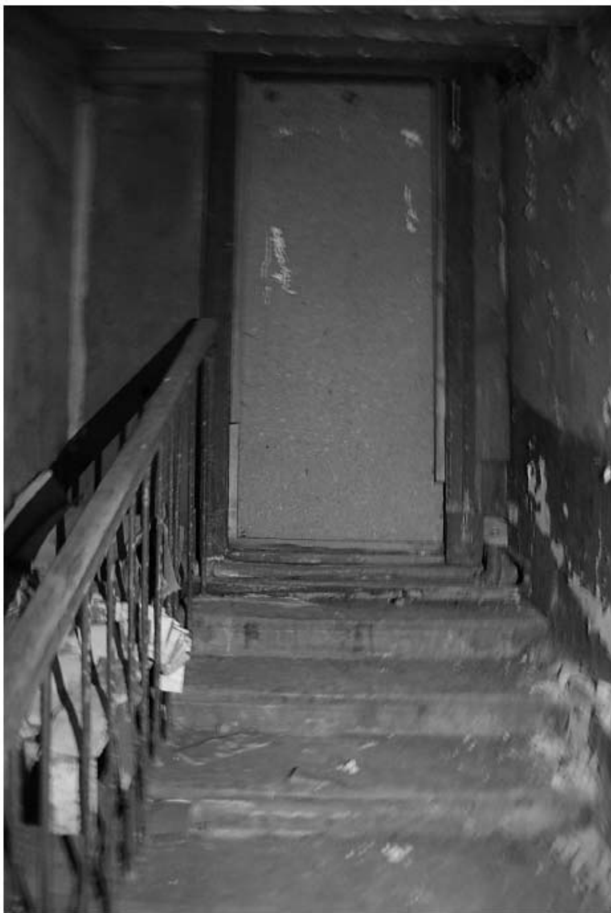
955. Подвал, помещение 6-Н. Интерьер лестницы на 1 этаж.
