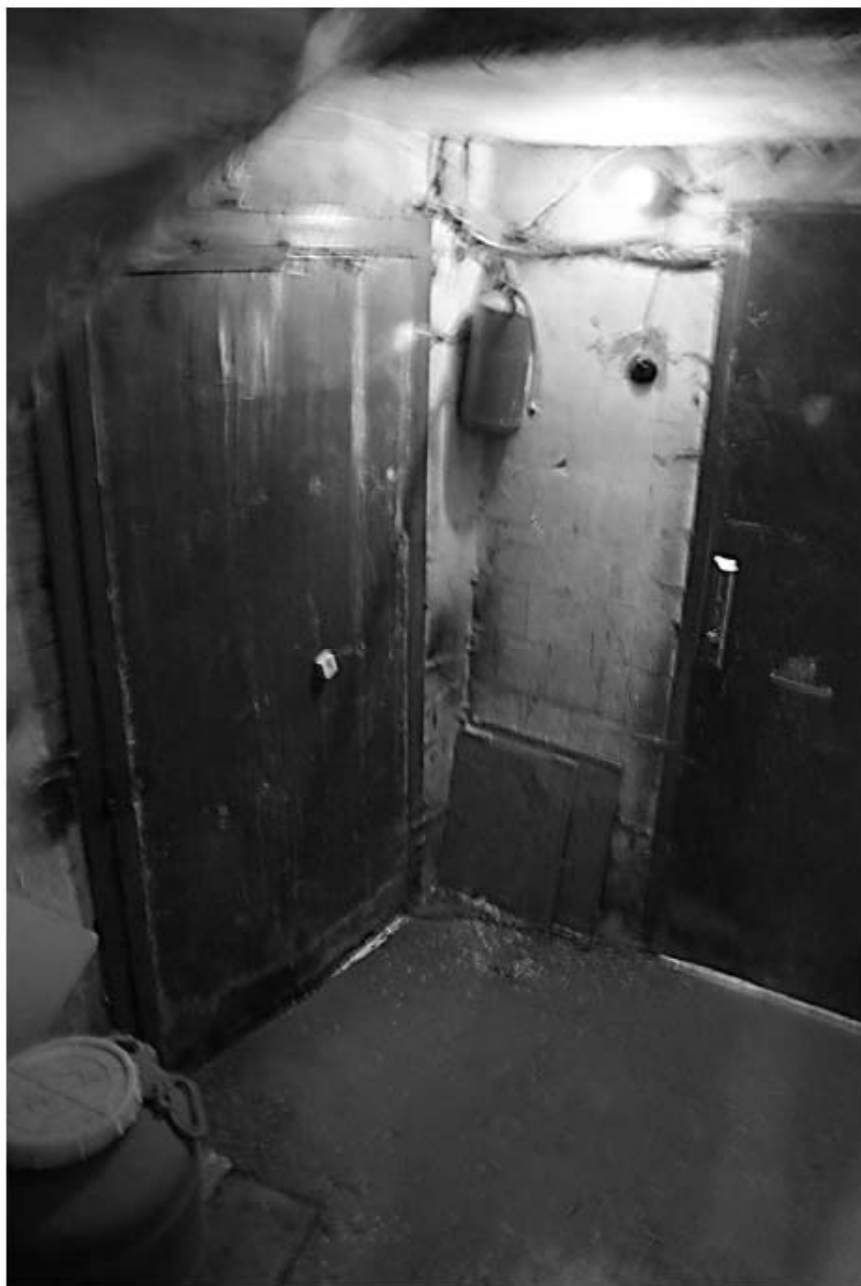
1049. Вход в подвал с лестницы 4ЛК.
