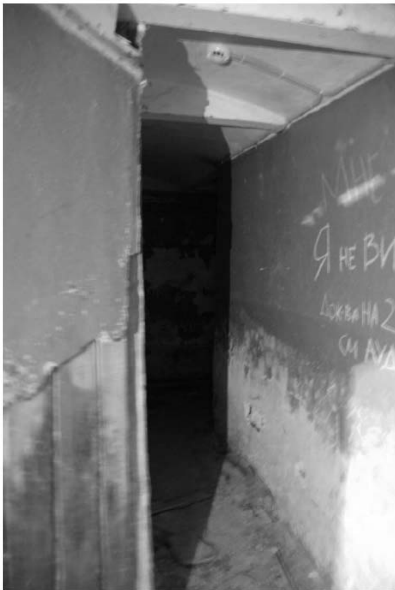
944. Подвал. Вход в помещение 29-Н.
