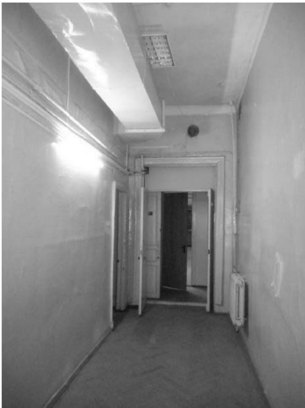
662. Этаж 3, помещение 17-Н. Вид коридора.
