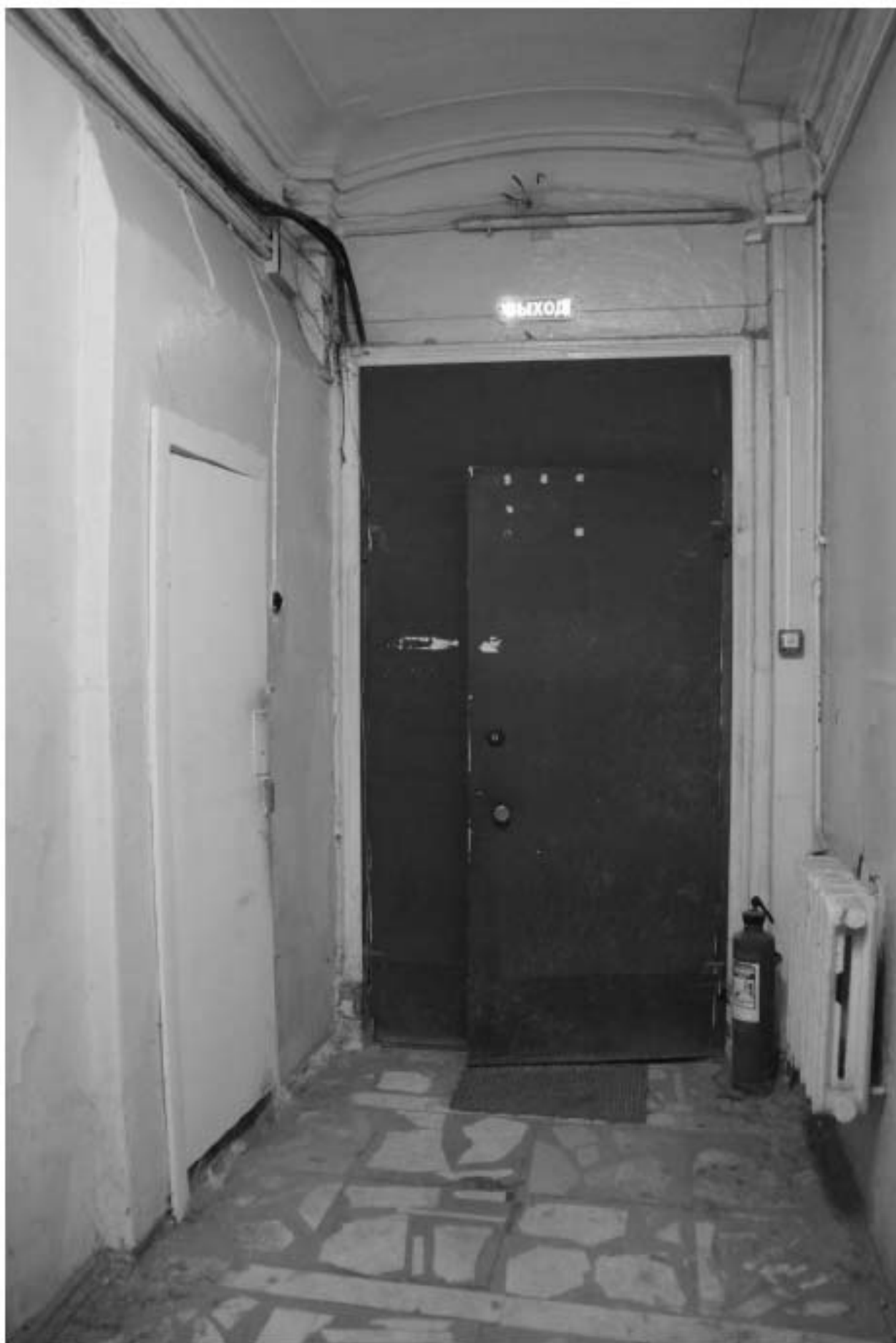
343. Этаж 1, помещение 15-Н. Вид коридора.
