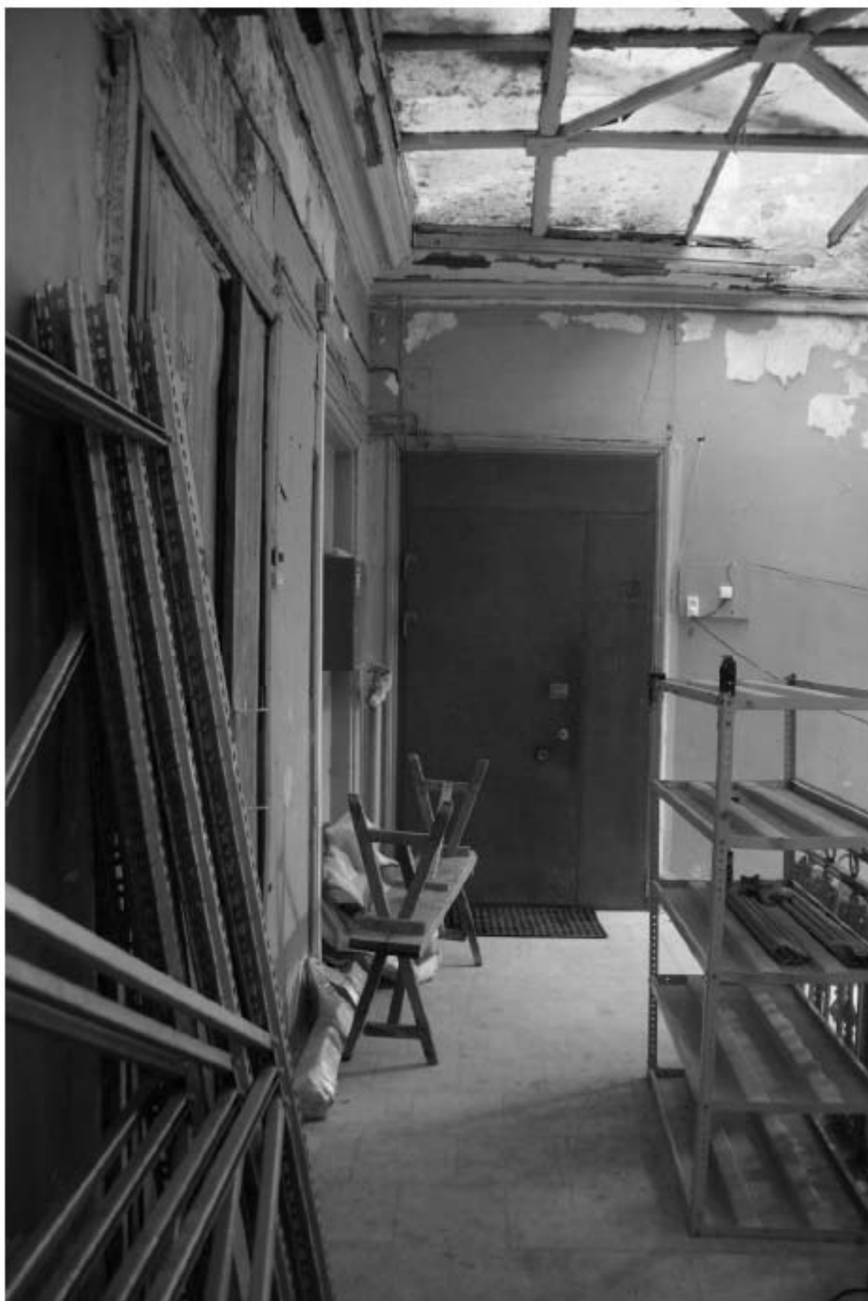
158. Лестничная площадка 5 этажа.
