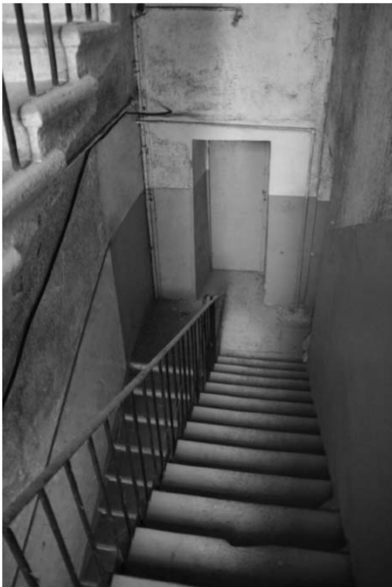
226. Лестница 4ЛК. Вид на лестничную площадку 2 этажа.
