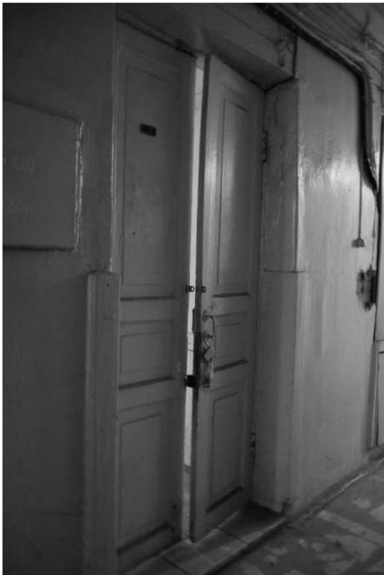
325. Этаж 1, помещение 15-Н. Входная дверь комнаты 25,1 кв.м.
