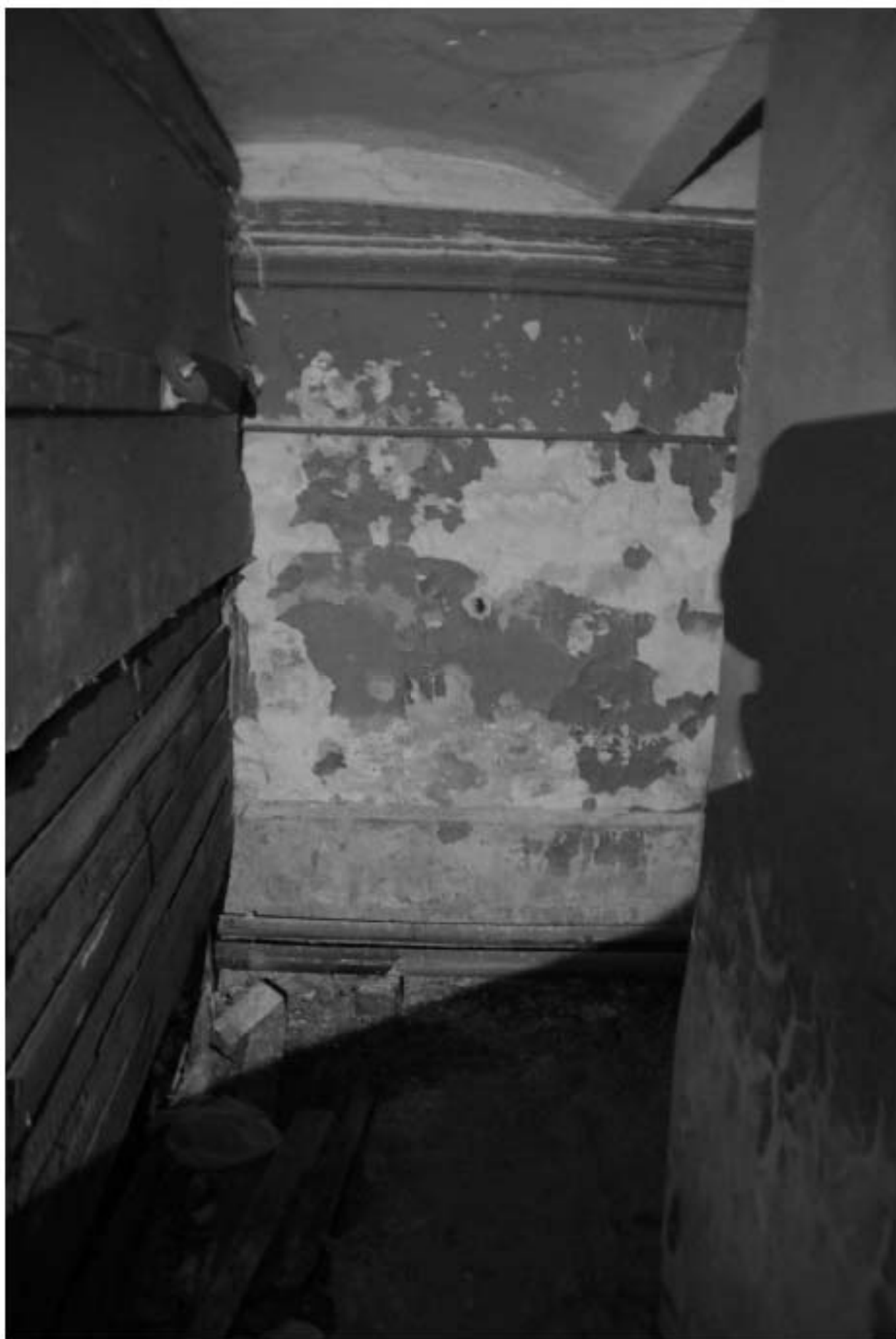
945. Подвал. Интерьер помещения 29-Н.
