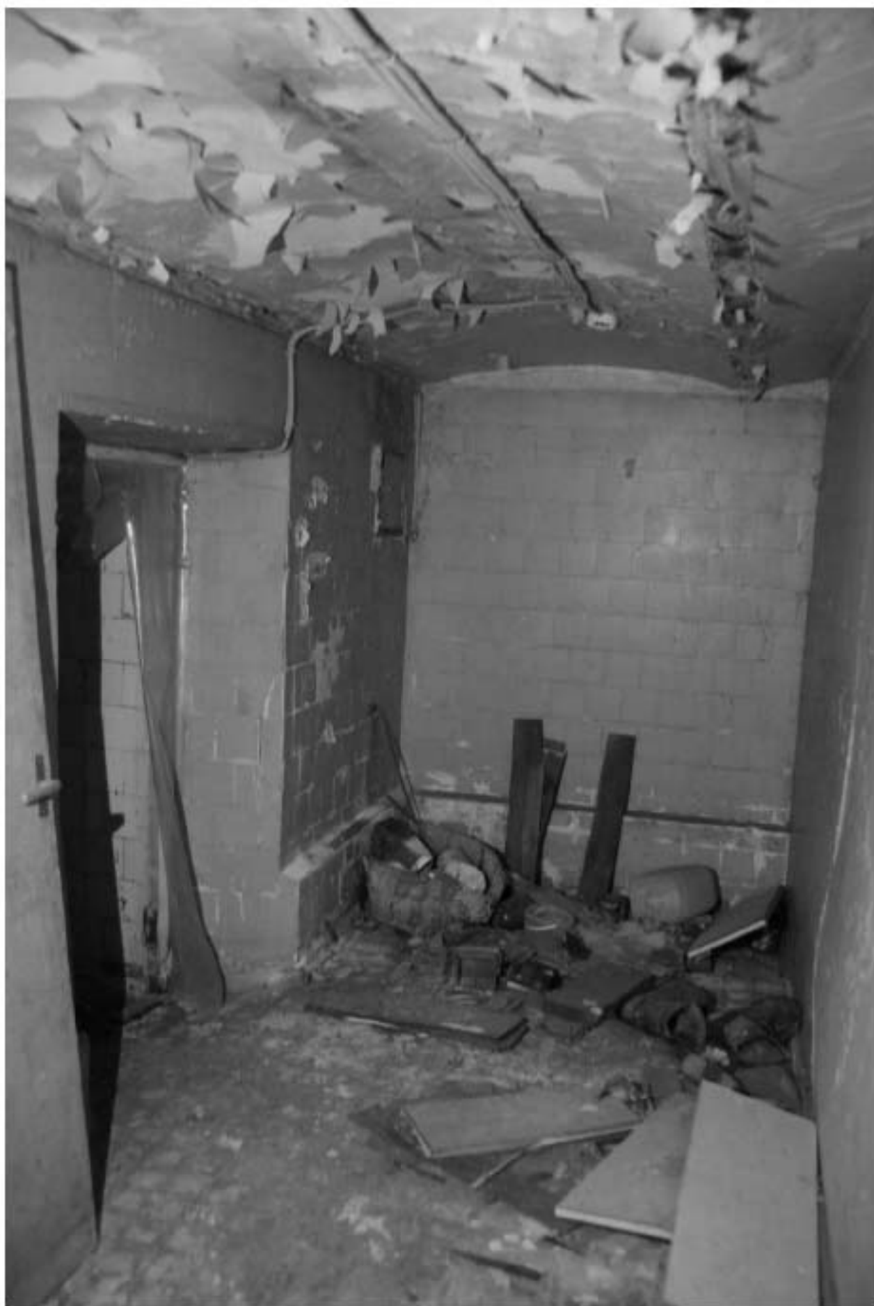
972. Подвал, помещение 6-Н. Вид коридора.
