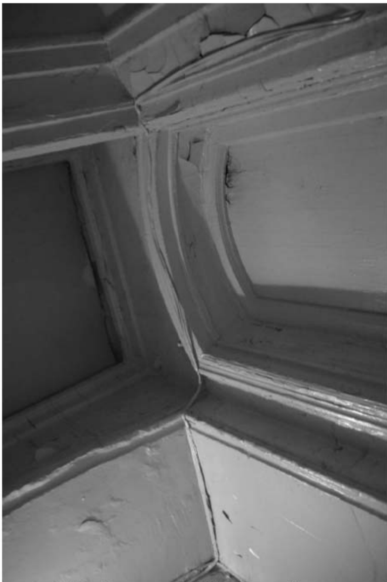
272. Этаж 1, помещение 20-Н. Интерьер входной группы.
