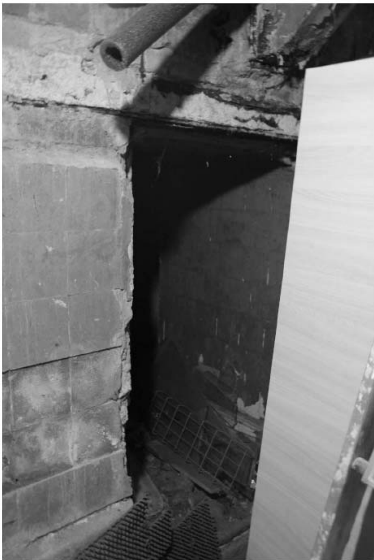
1022. Подвал. Вход в помещение 5-Н.
