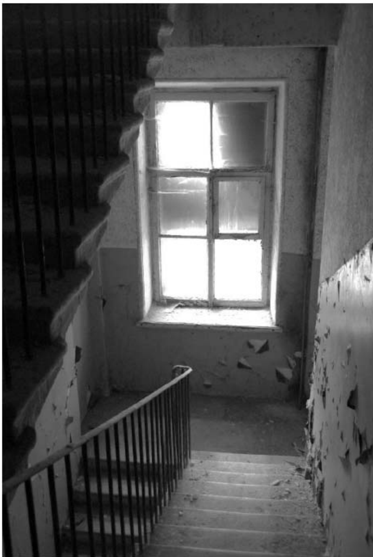
240. Лестница 4ЛК. Вид на лестничную площадку между 4 и 5 этажами.
