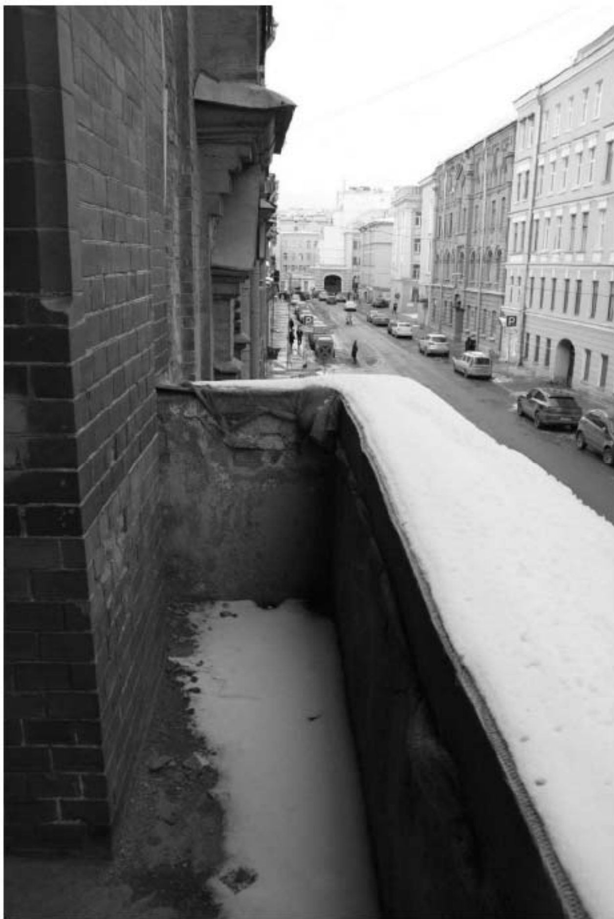
478. Этаж 2, помещение 30-Н. Балкон.
