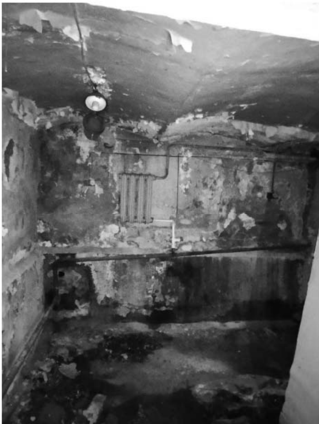
1004. Подвал, помещение 6-Н. Интерьер комнаты 14,9 кв.м.
