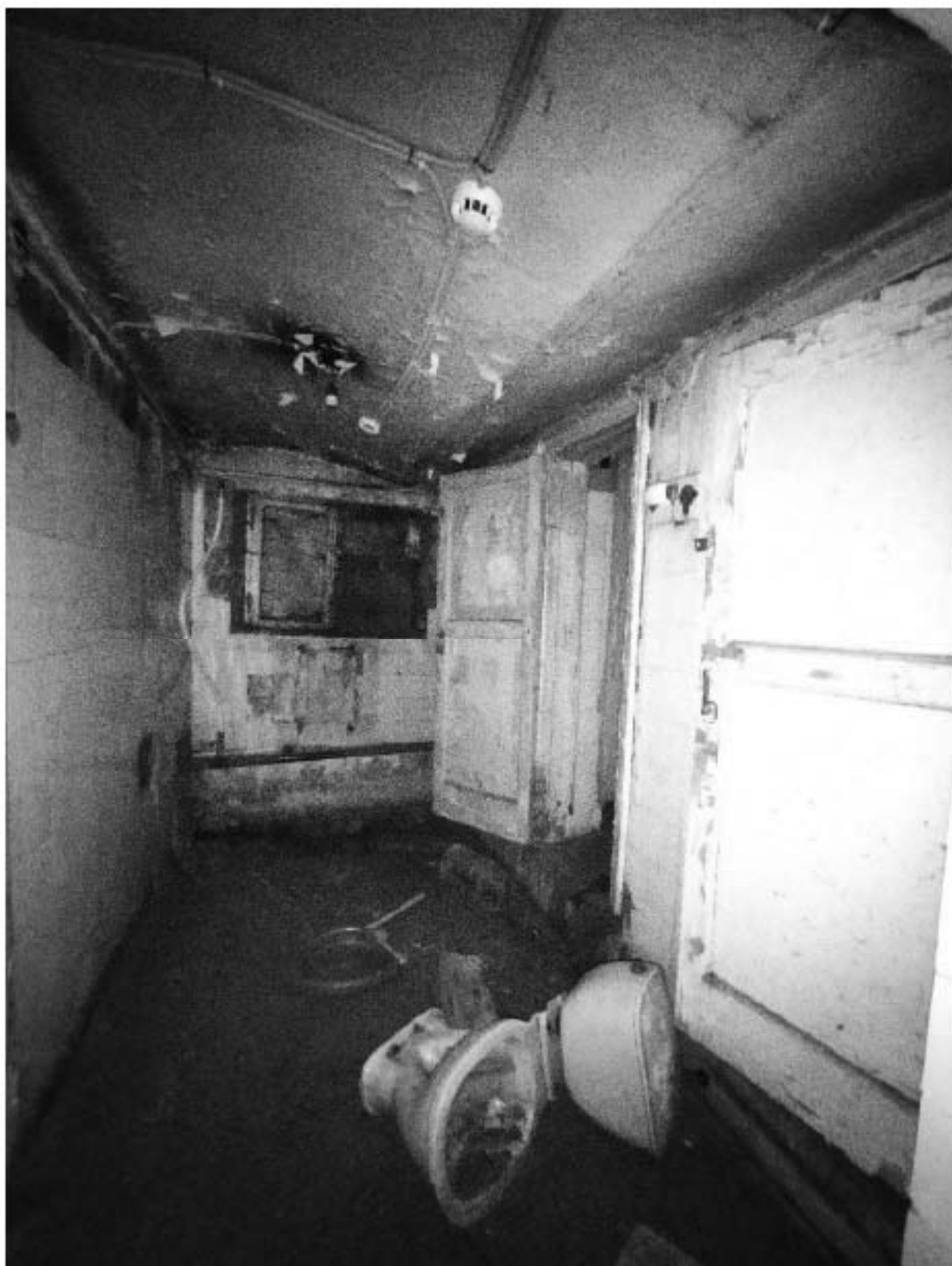
987. Подвал, помещение 6-Н. Интерьер комнаты 5,9 кв.м.
