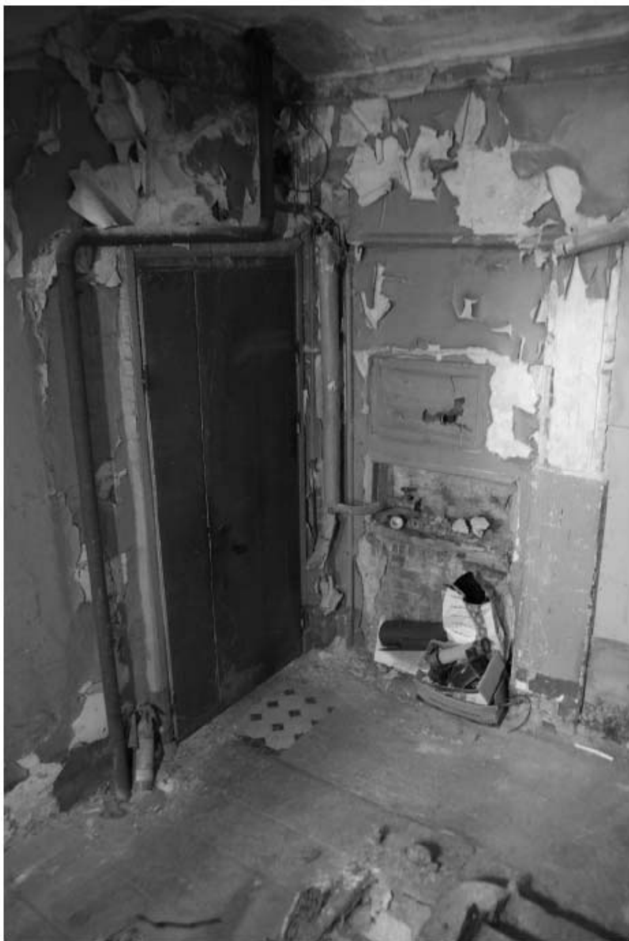
688. Лестница ЗЛК. Лестничная площадка 1 этажа.
