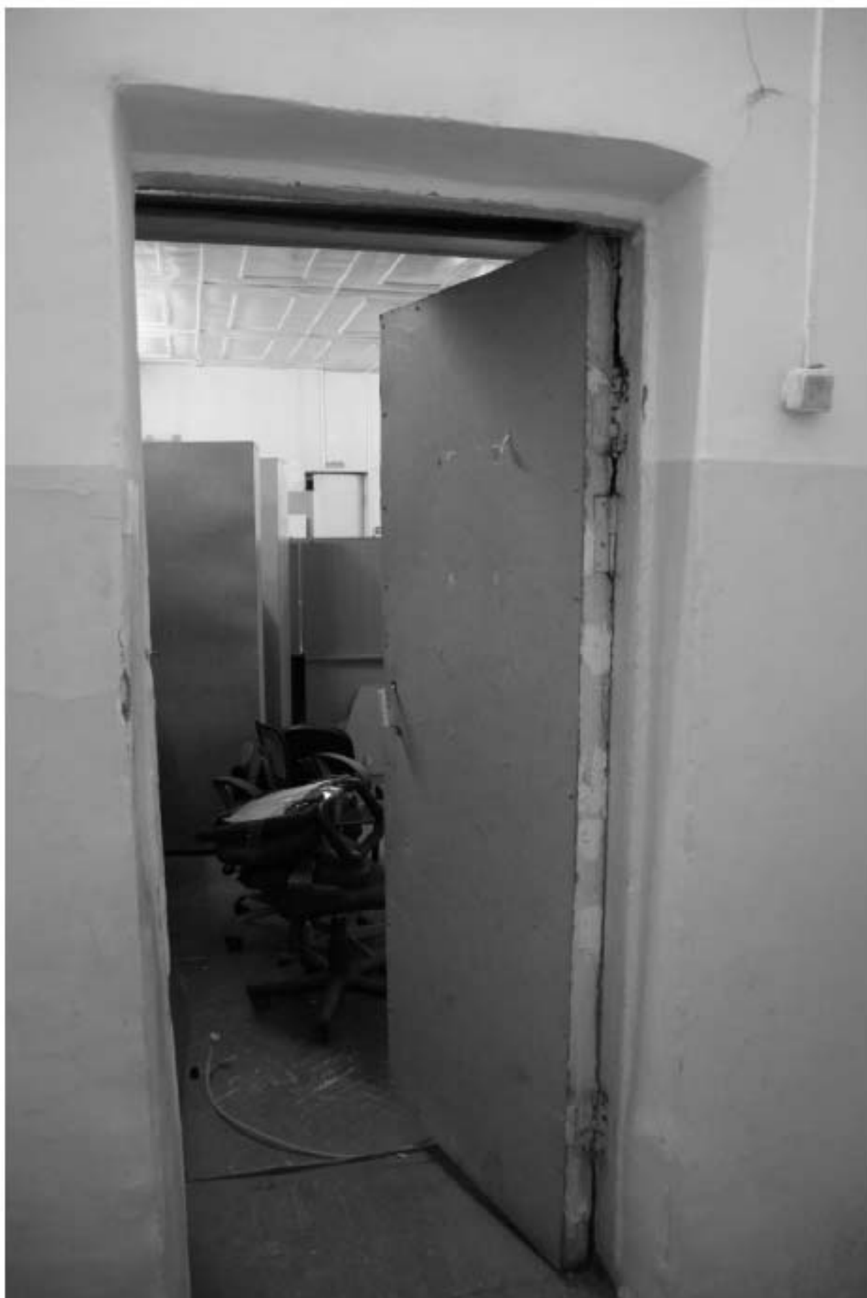
276. Этаж 1, помещение 20-Н. Вид из комнаты 4,7 кв.м. в зал.
