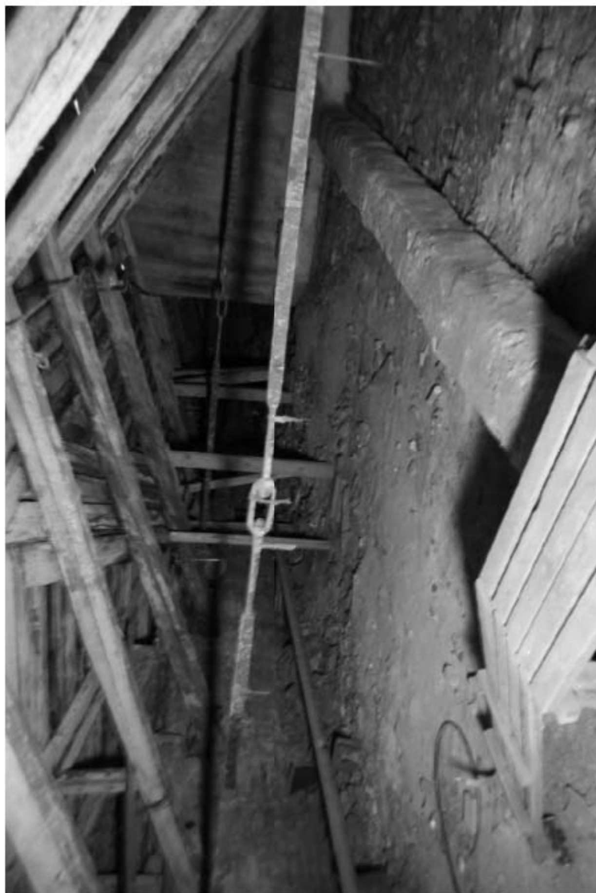
848. Этаж 5, интерьер чердака.
