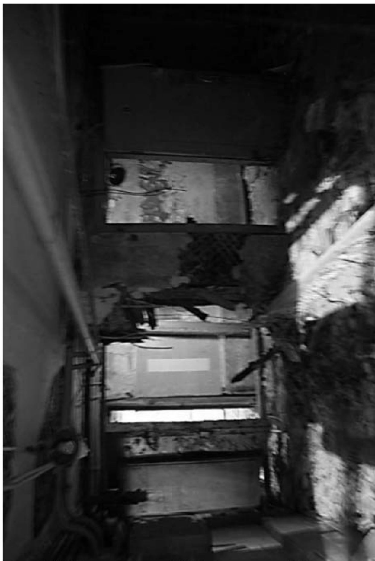
958. Подвал, помещение 6-Н. Интерьер комнаты 20,8 кв.м.
