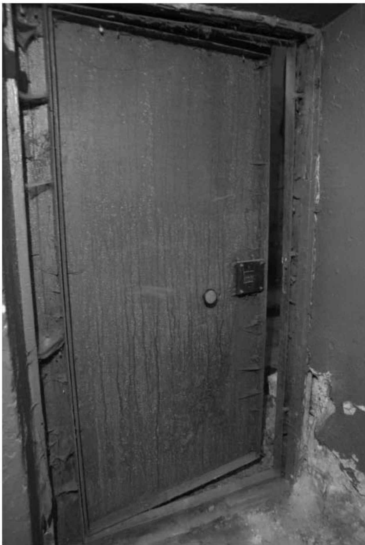
1013. Подвал, интерьер помещения 10-Н.
