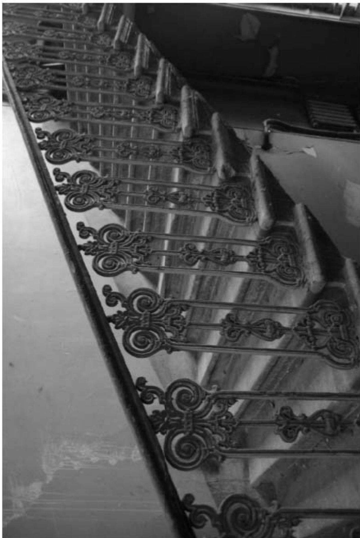
1193. Лестница ЗЛК. Ограждение лестницы.
