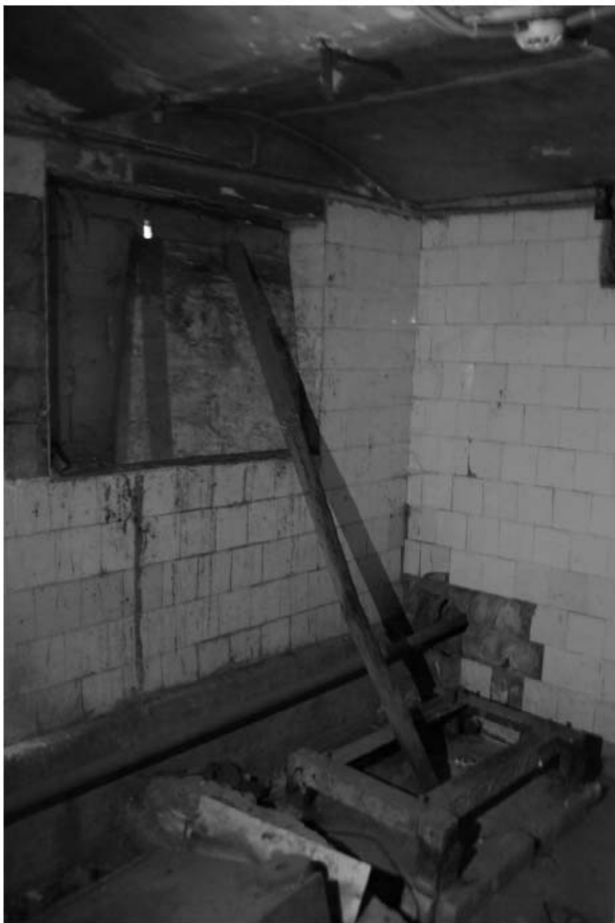
982. Подвал, помещение 6-Н. Интерьер комнаты 9,4 кв.м.
