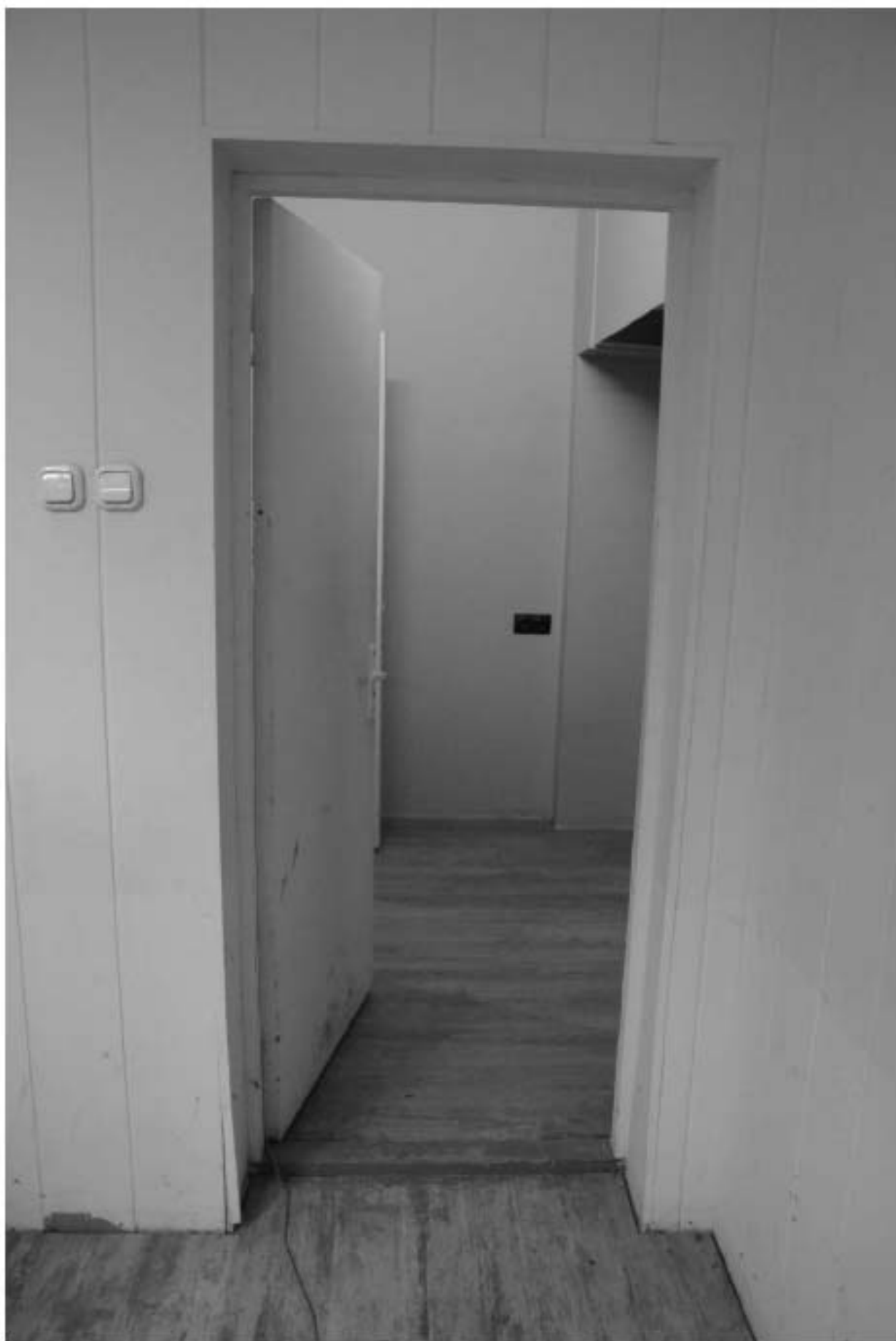
397. Этаж 1, помещение 15-Н. Вход в комнату 3,8 кв. м.
