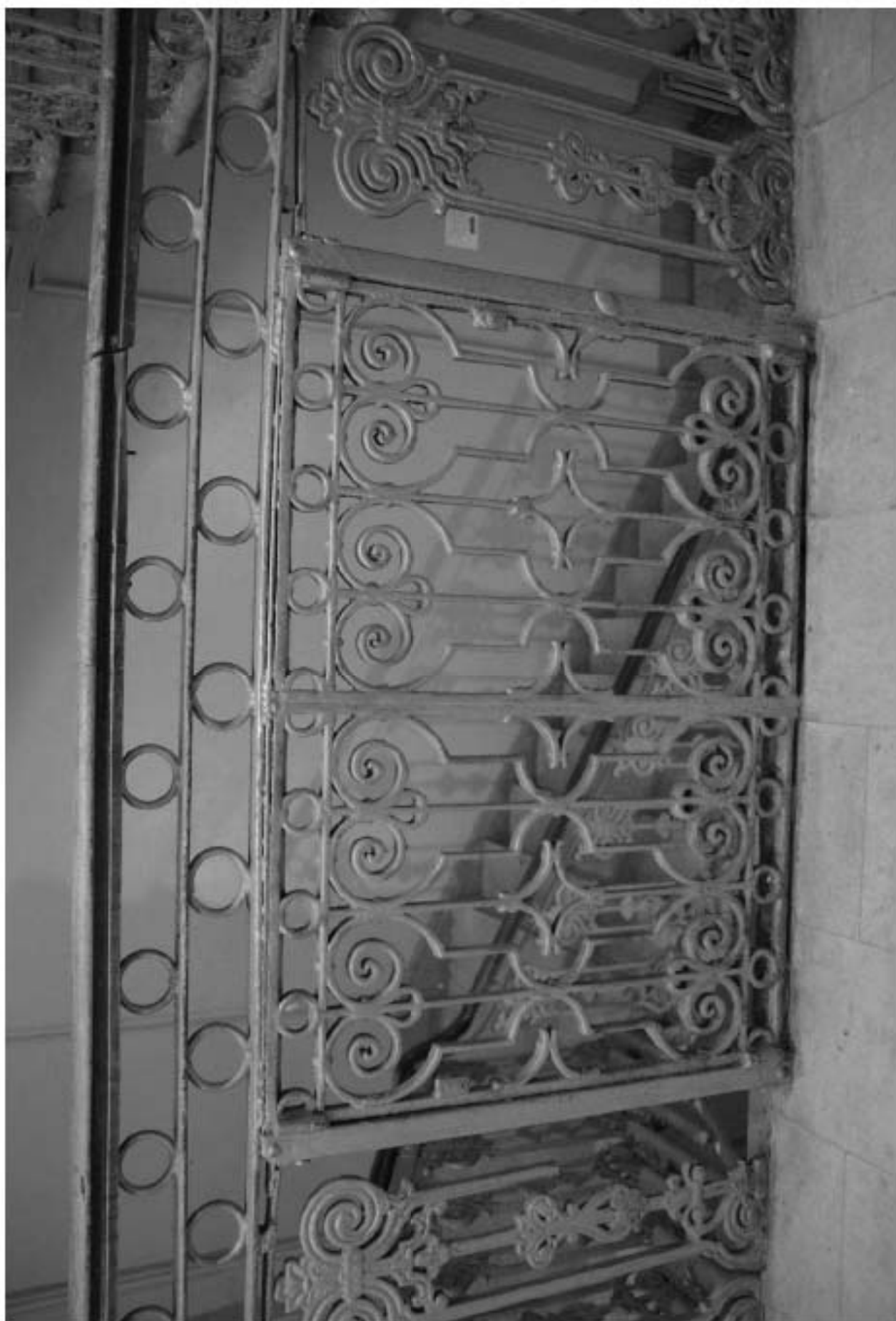
140. Створки ограждения лестничной площадки 2 этажа.
