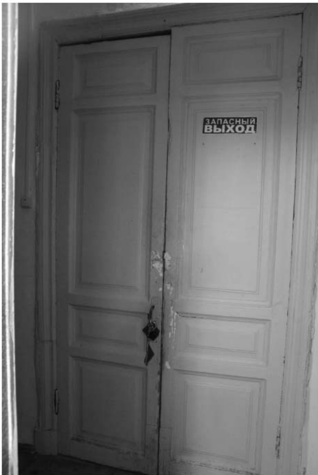
580. Этаж 2, помещение 16-Н. Дверь на лестницу ЗЛК.
