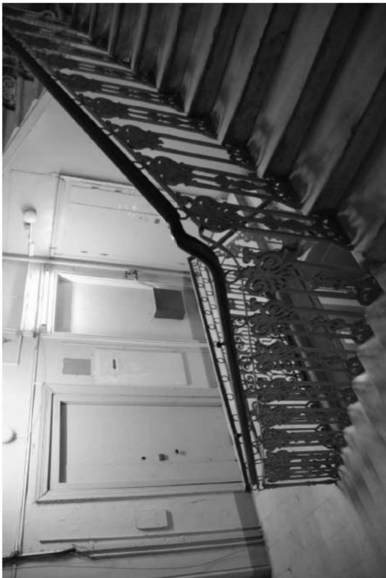
143. Вид на лестничную площадку 3 этажа.
