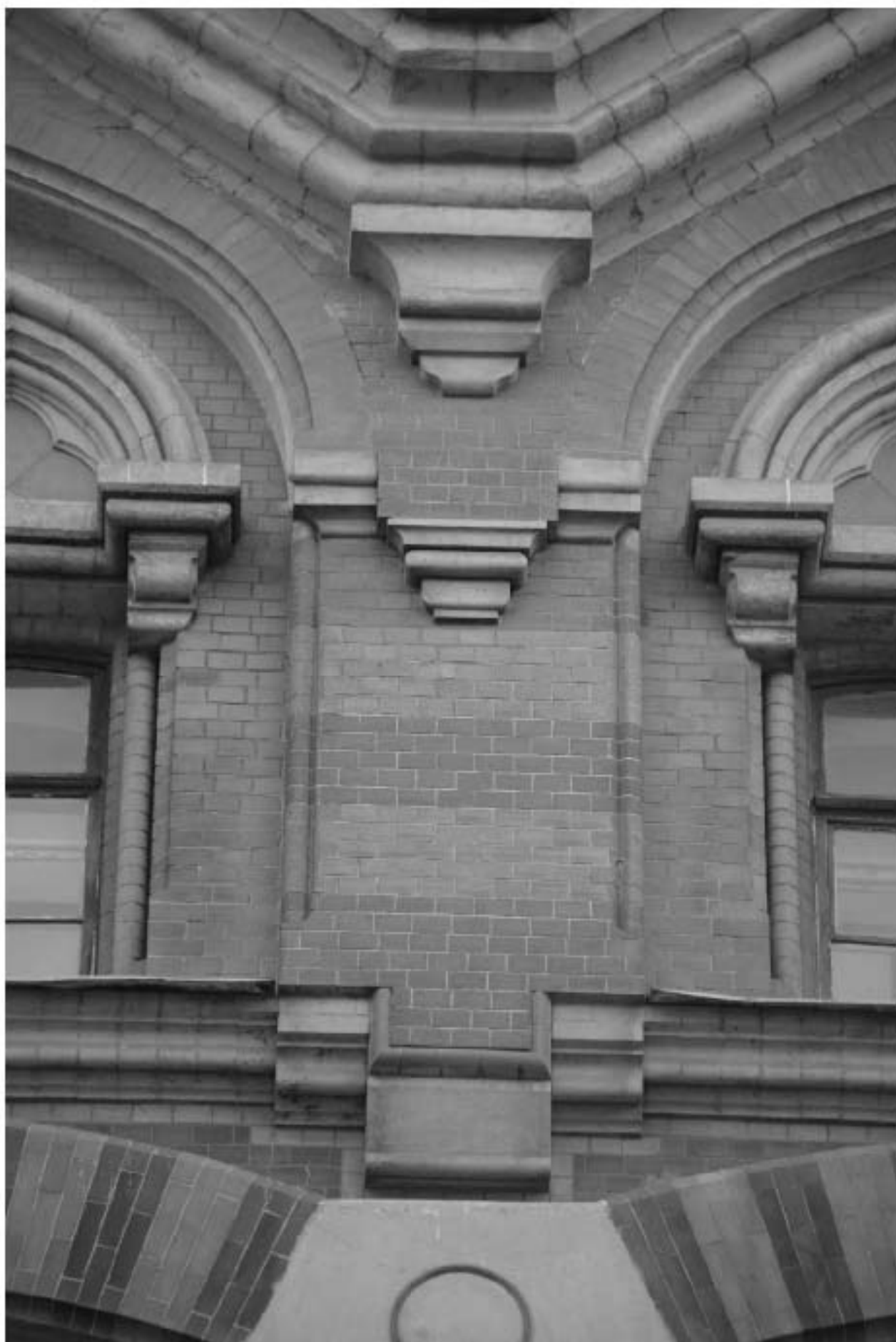
10. Фрагмент лицевого фасада.
