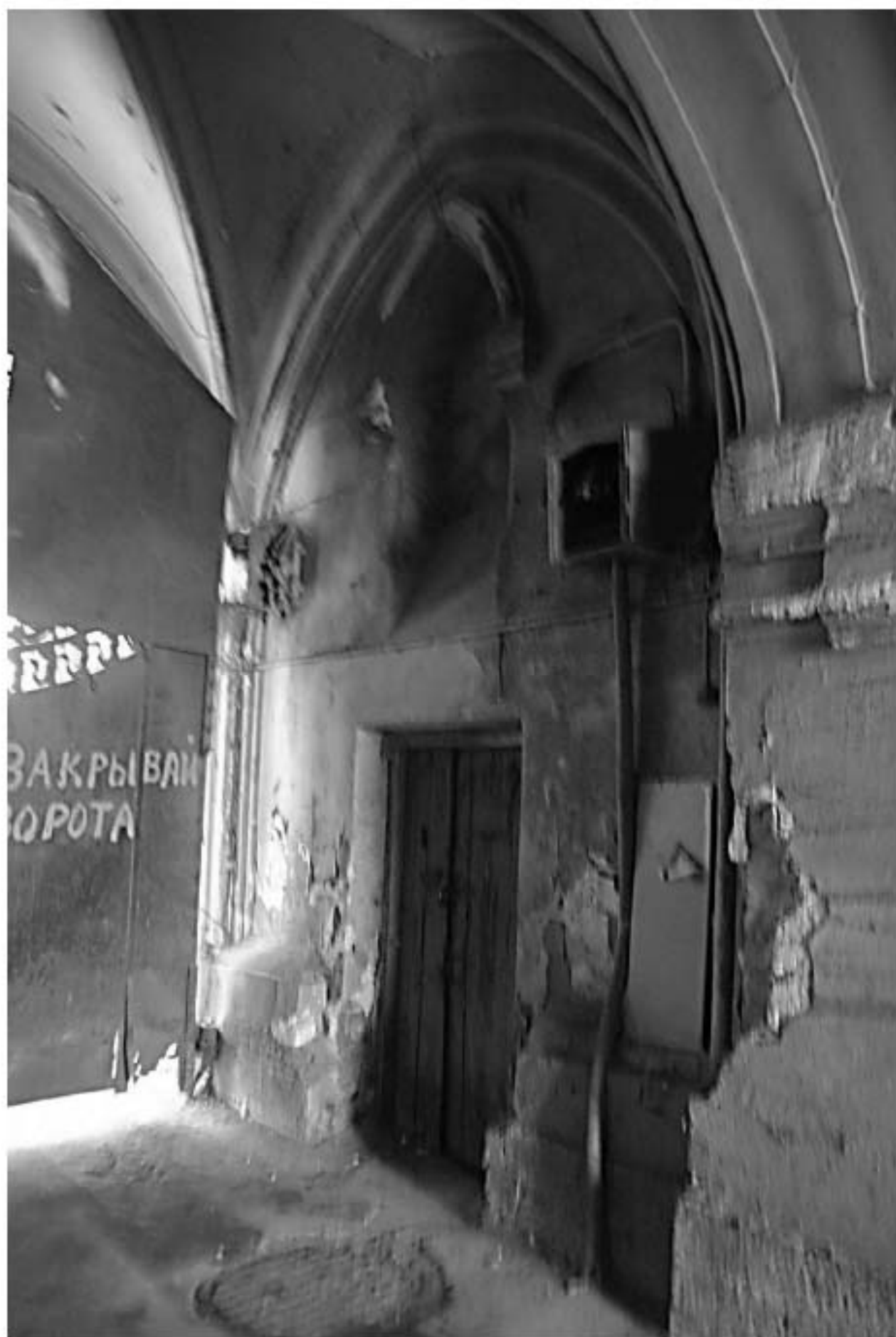
65. Воротный проезд лицевого корпуса. Фрагмент.
