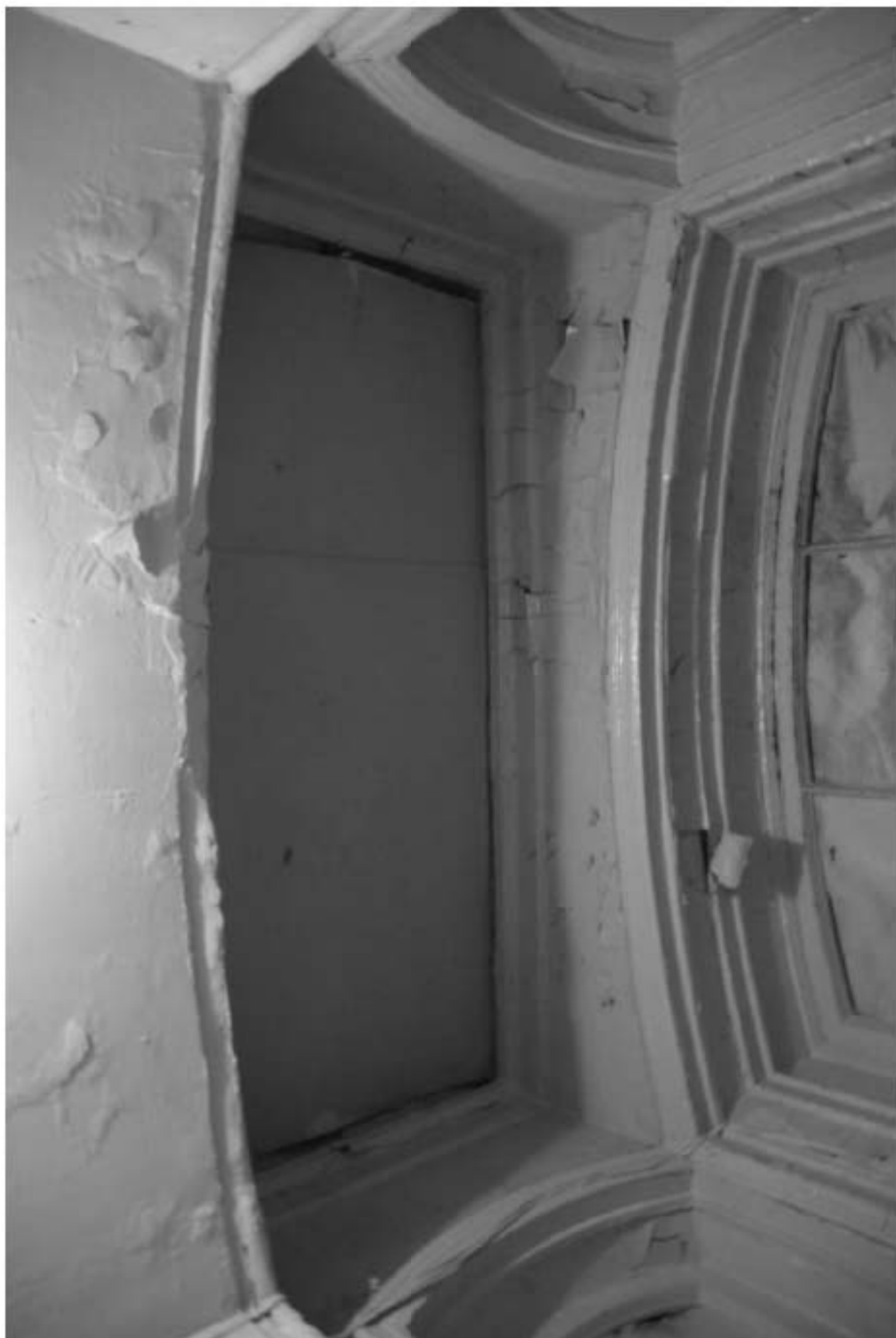
269. Этаж 1, помещение 20-Н. Интерьер входной группы.
