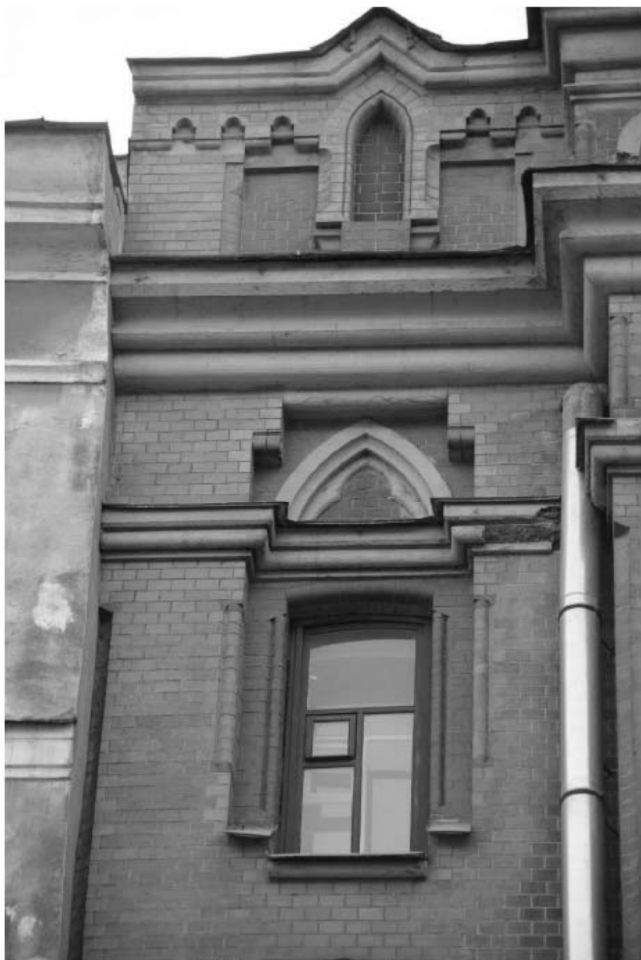
27. Фрагмент лицевого фасада.
