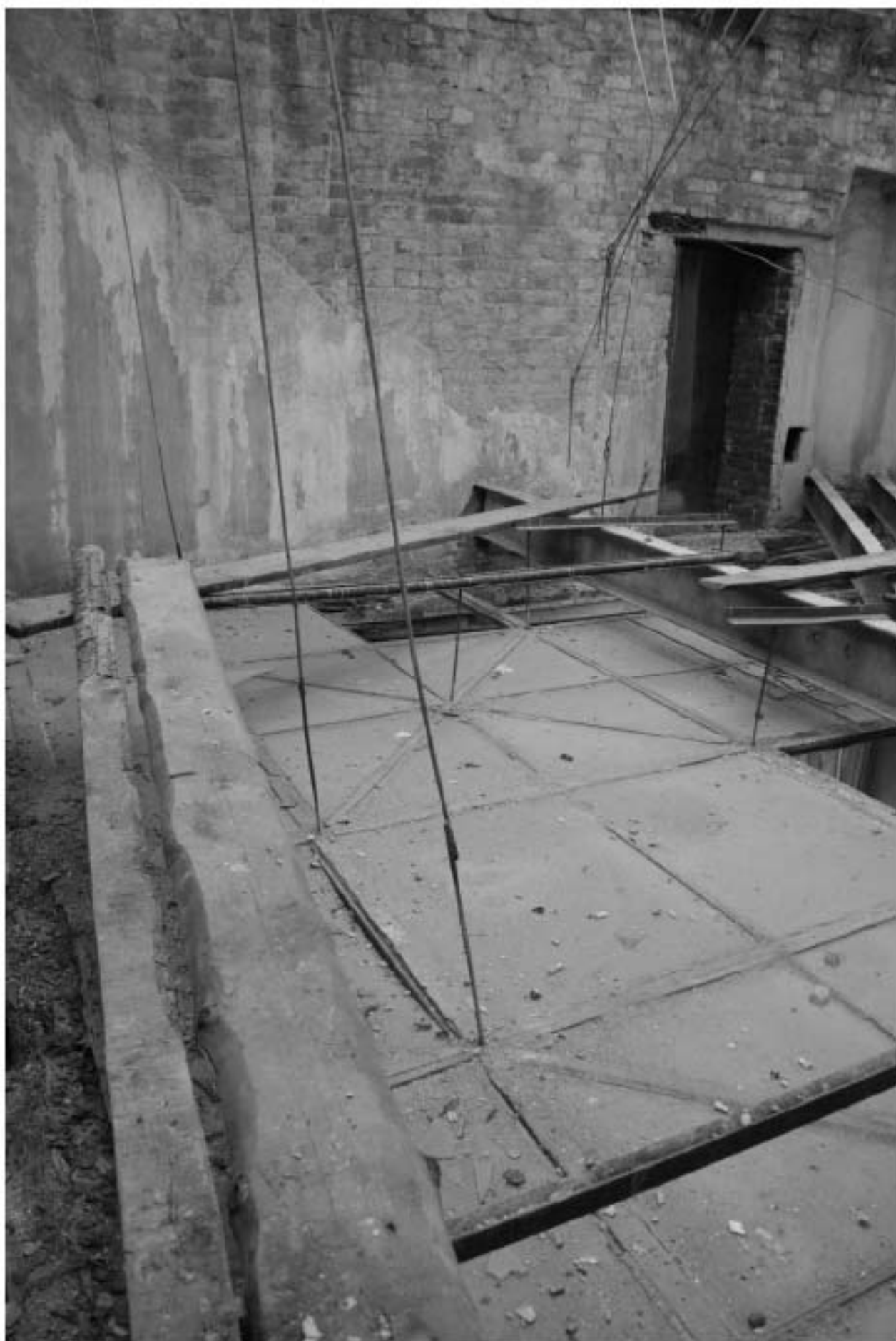
898. Чердак. Вид на конструкции светового фонаря.
