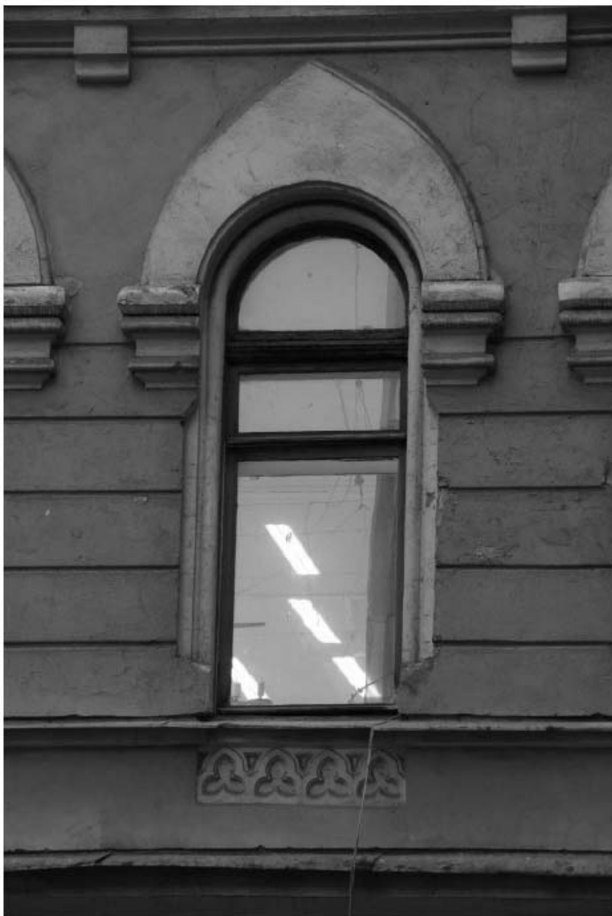
90. Фрагмент дворового фасада.
