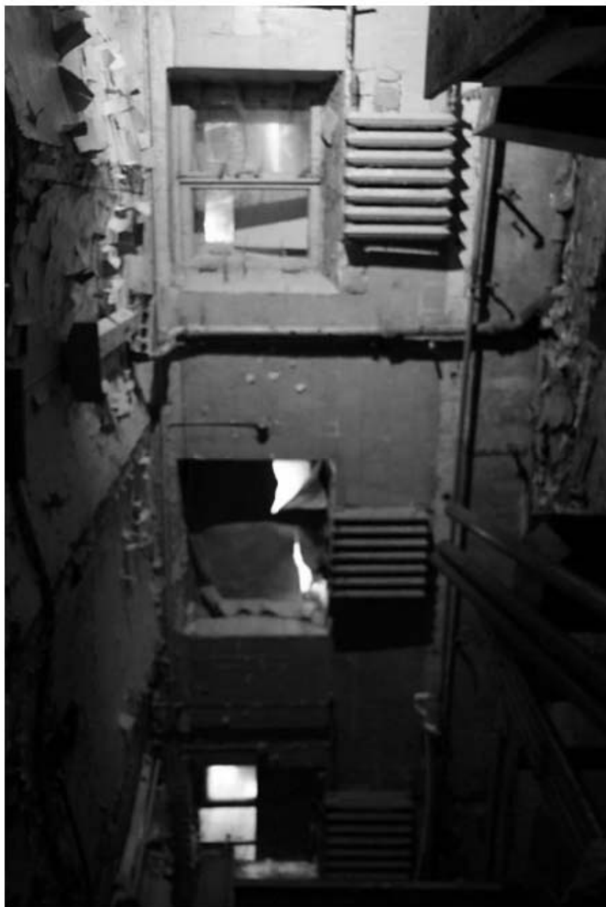
967. Подвал, помещение 6-Н. Вид коридора.
