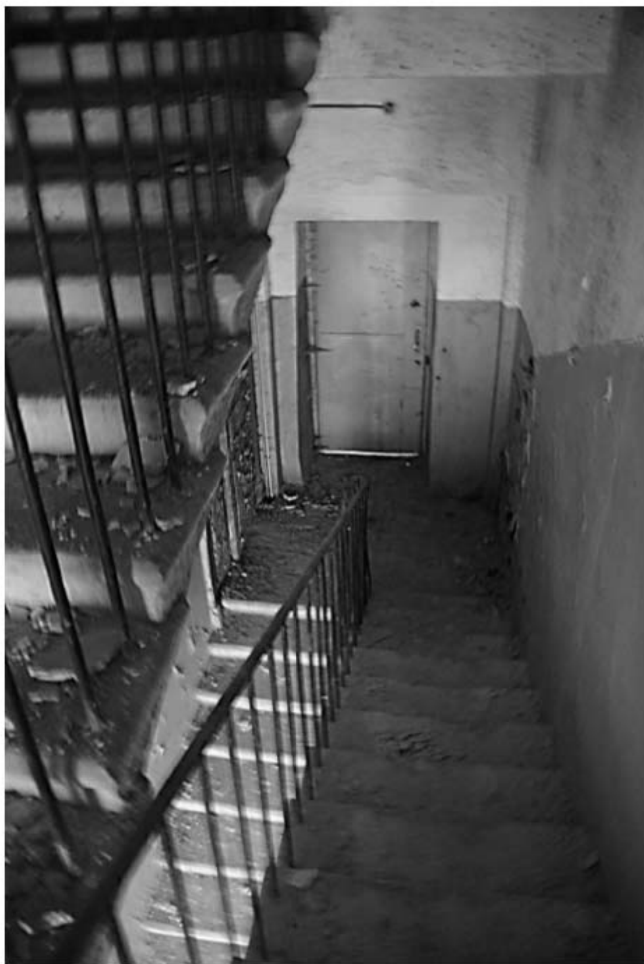
242. Лестница 4ЛК. Лестничная площадка 5 этажа.
