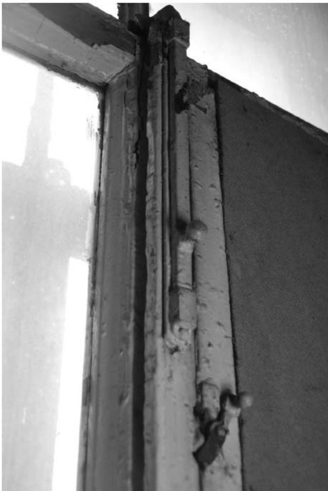
203. Лестница 3ЛК. Фурнитура деревянного окна.
