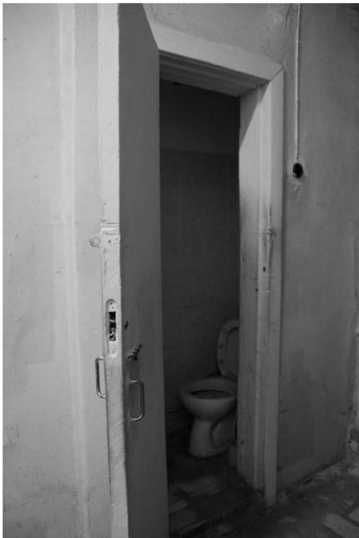
344. Этаж 1, помещение 15-Н. Вид коридора.
