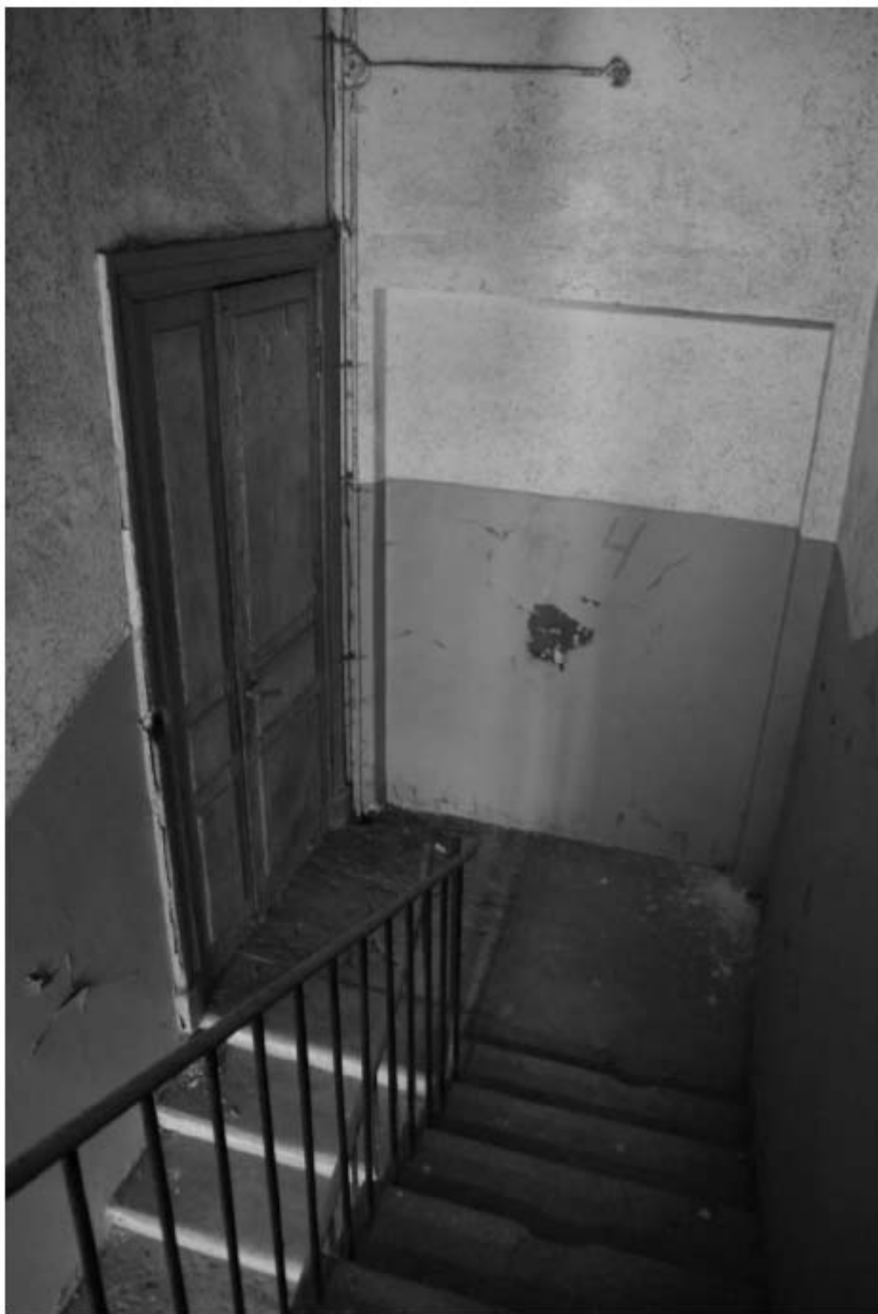
236. Лестница 4ЛК. Лестничная площадка 4 этажа.
