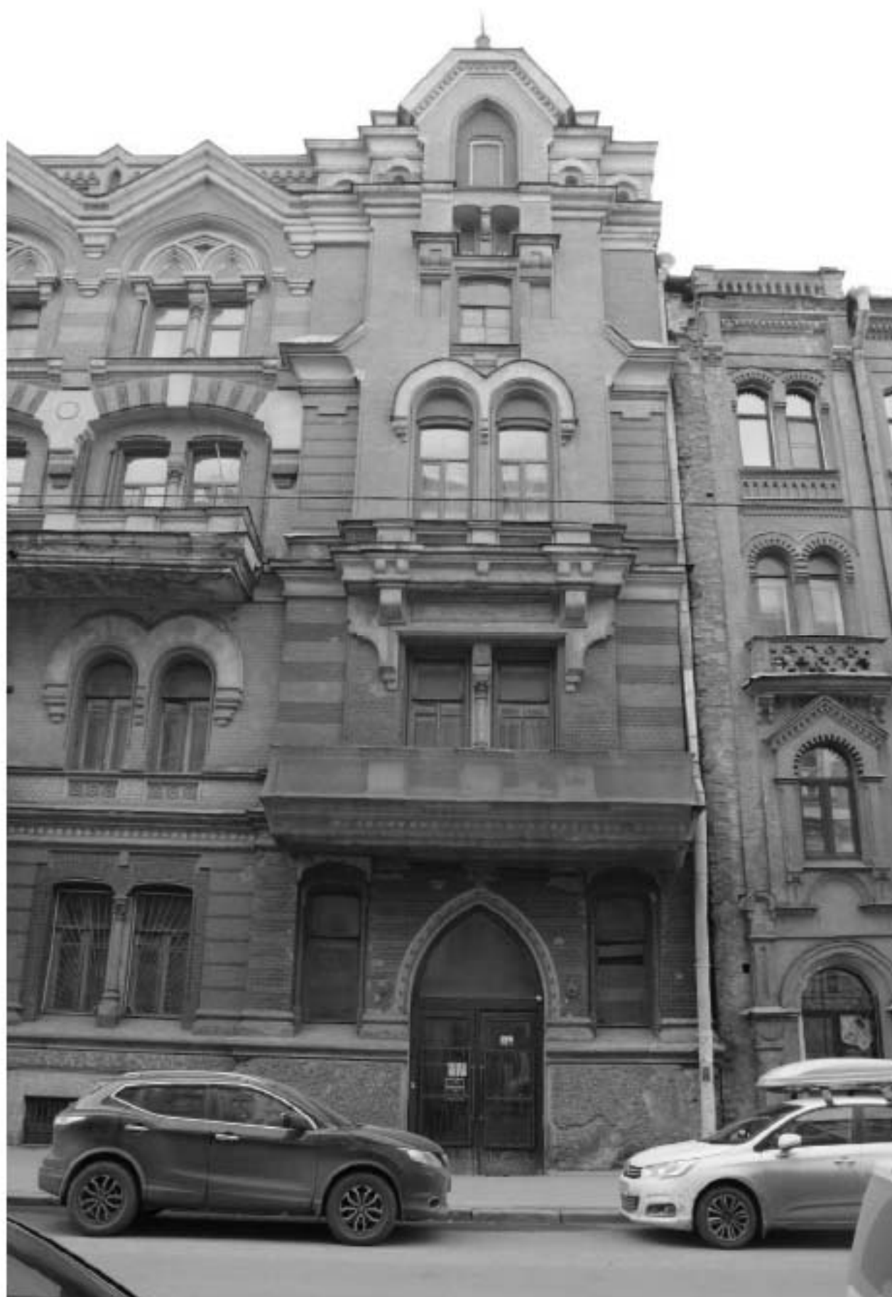
2. Фрагмент лицевого фасада.
