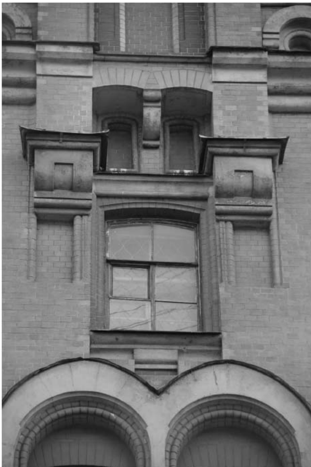
15. Фрагмент лицевого фасада.
