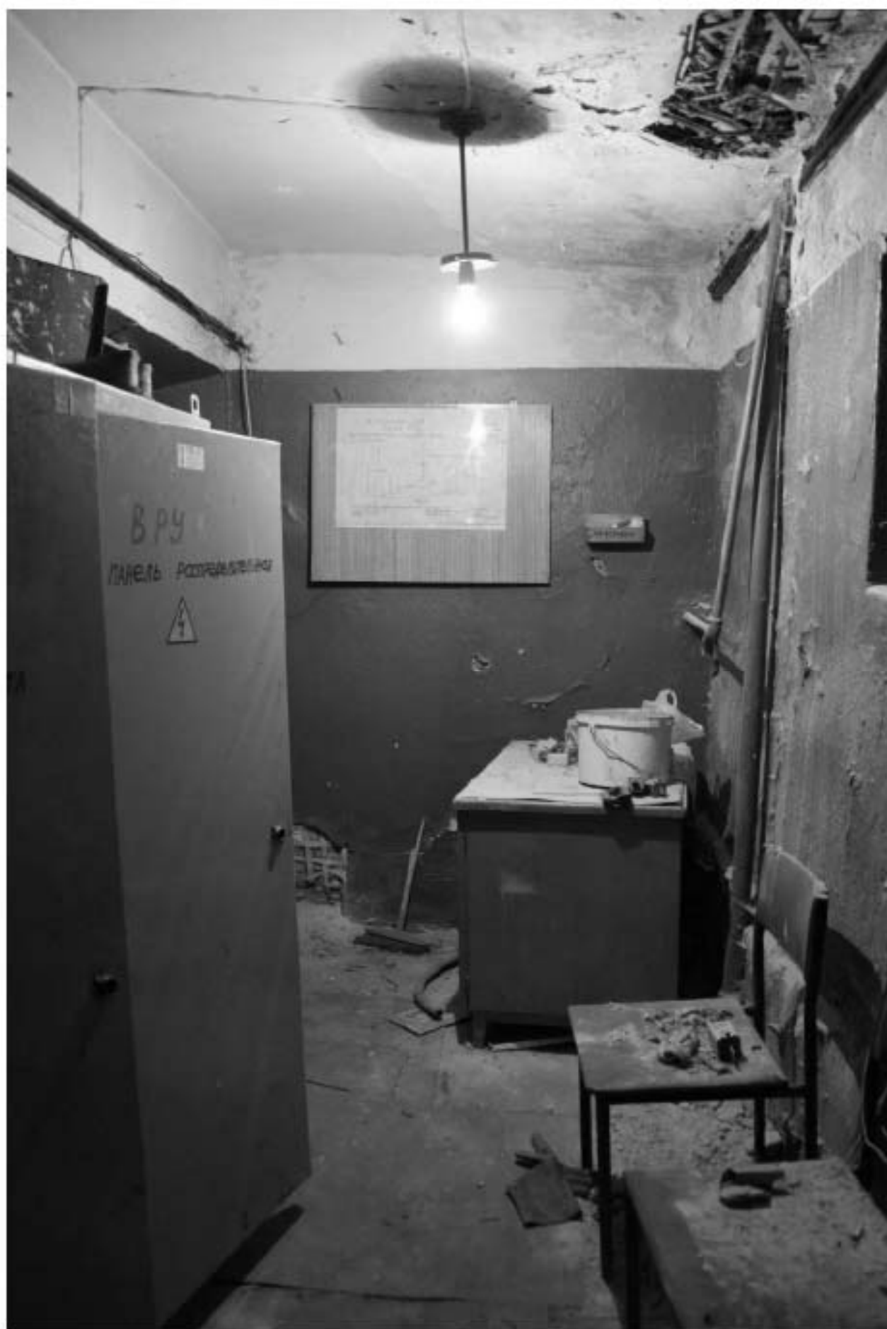
1012. Подвал, интерьер помещения 10-Н.
