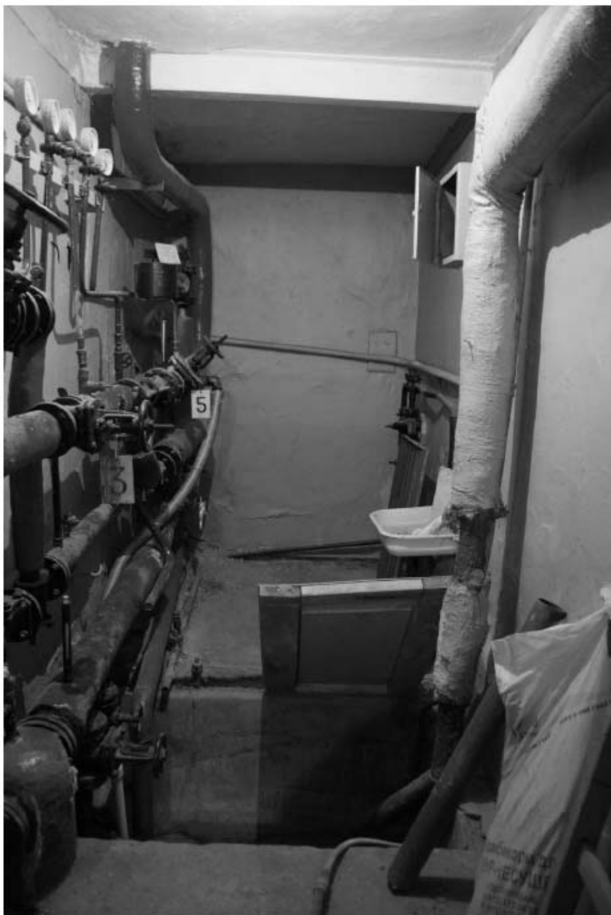
1009. Подвал, интерьер помещения 9-Н.
