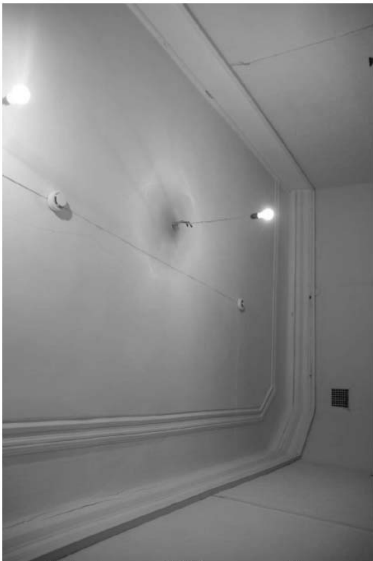
293. Этаж 1, помещение 20-Н. Потолок комнаты 18,0 кв.м.
