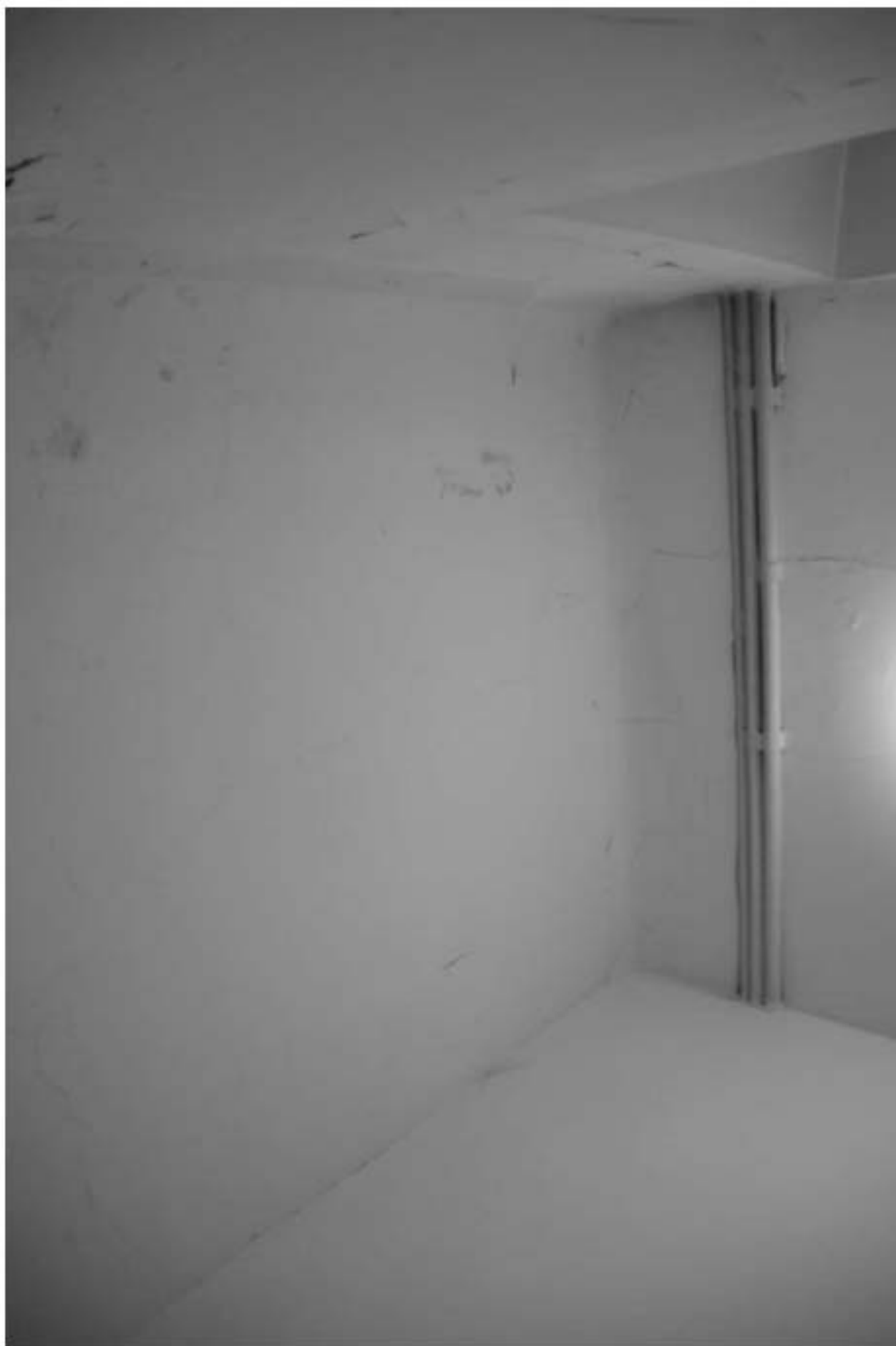
394. Этаж 1, помещение 15-Н. Интерьер душевой.
