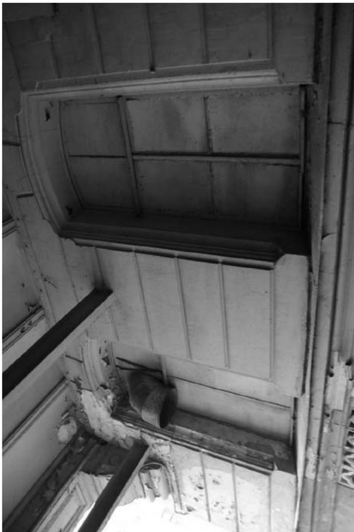
57. Воротный проезд лицевого корпуса. Фрагмент.
