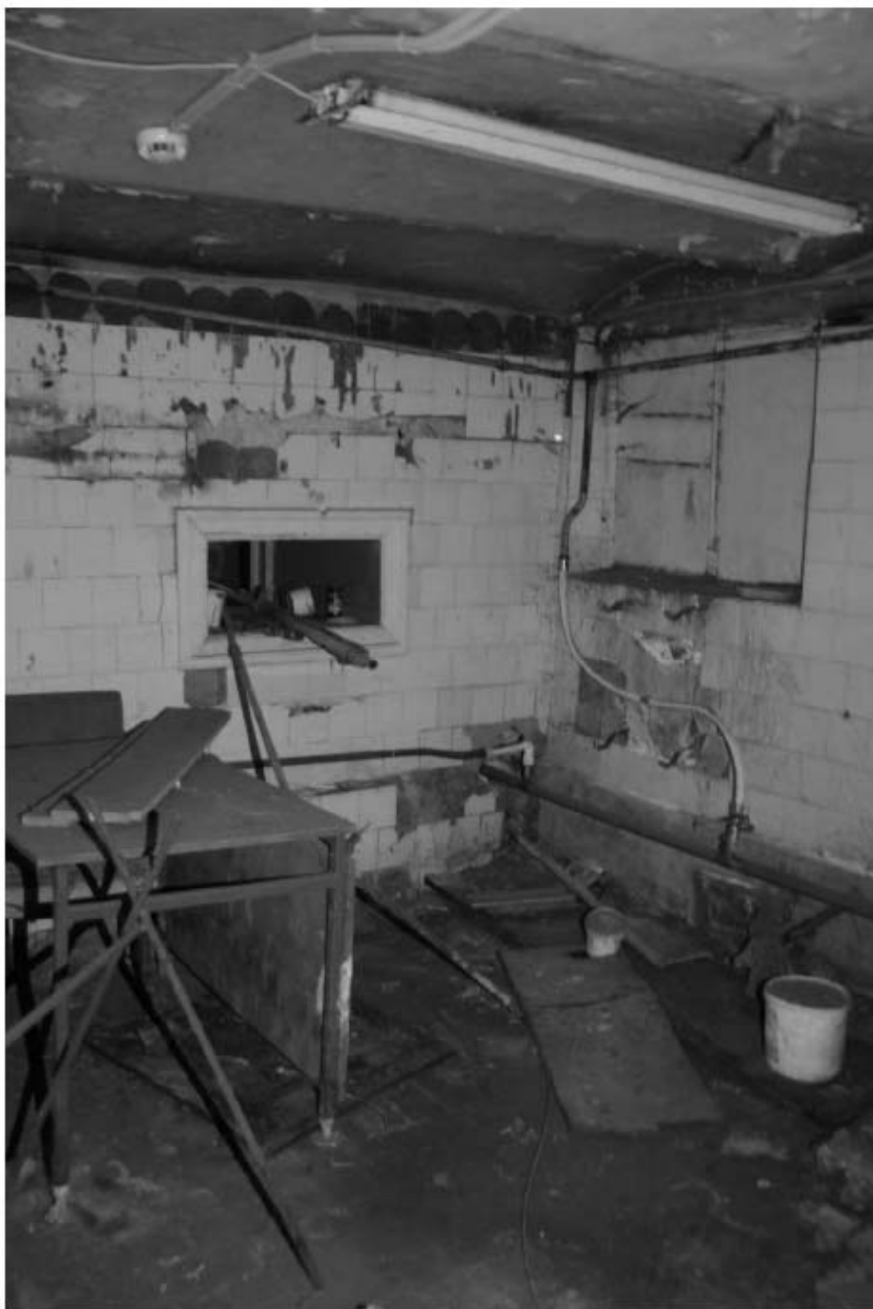
977. Подвал, помещение 6-Н. Интерьер комнаты 10,5 кв.м.
