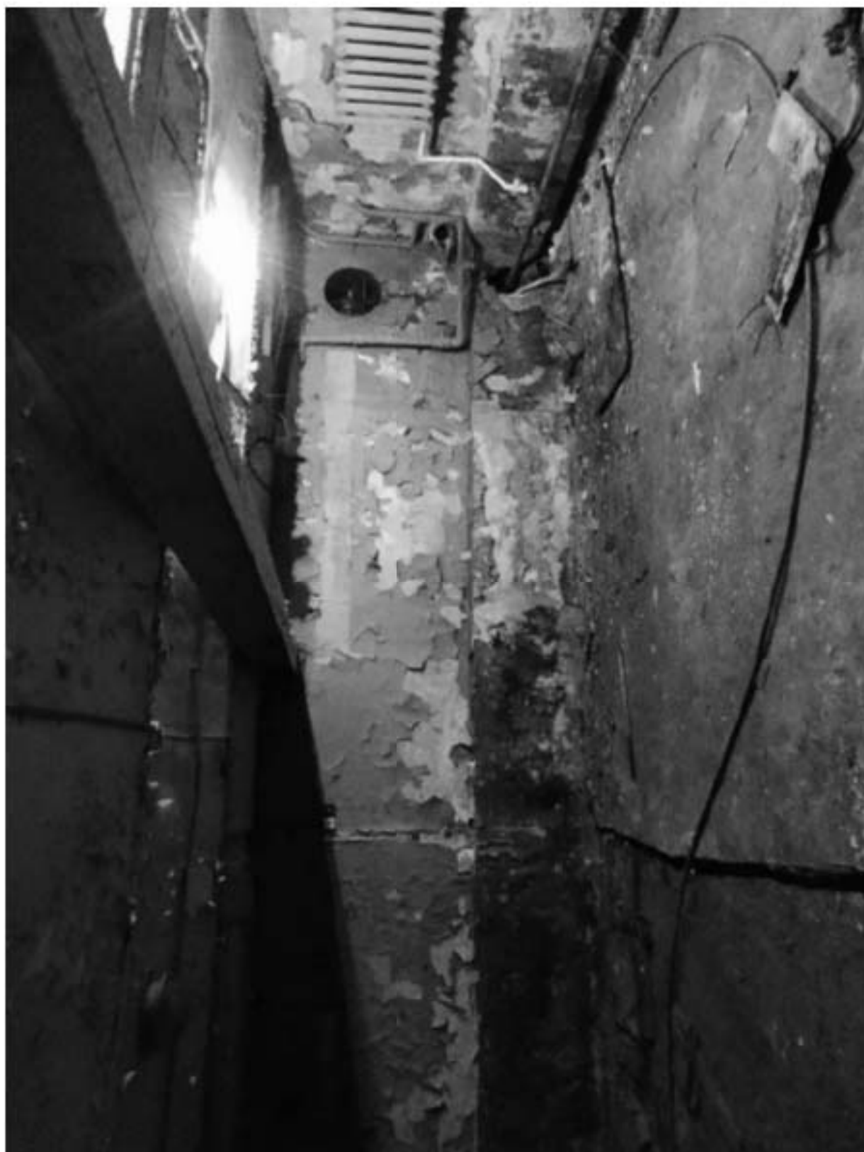
1001. Подвал, помещение 6-Н. Интерьер комнаты 57,8 кв.м.
