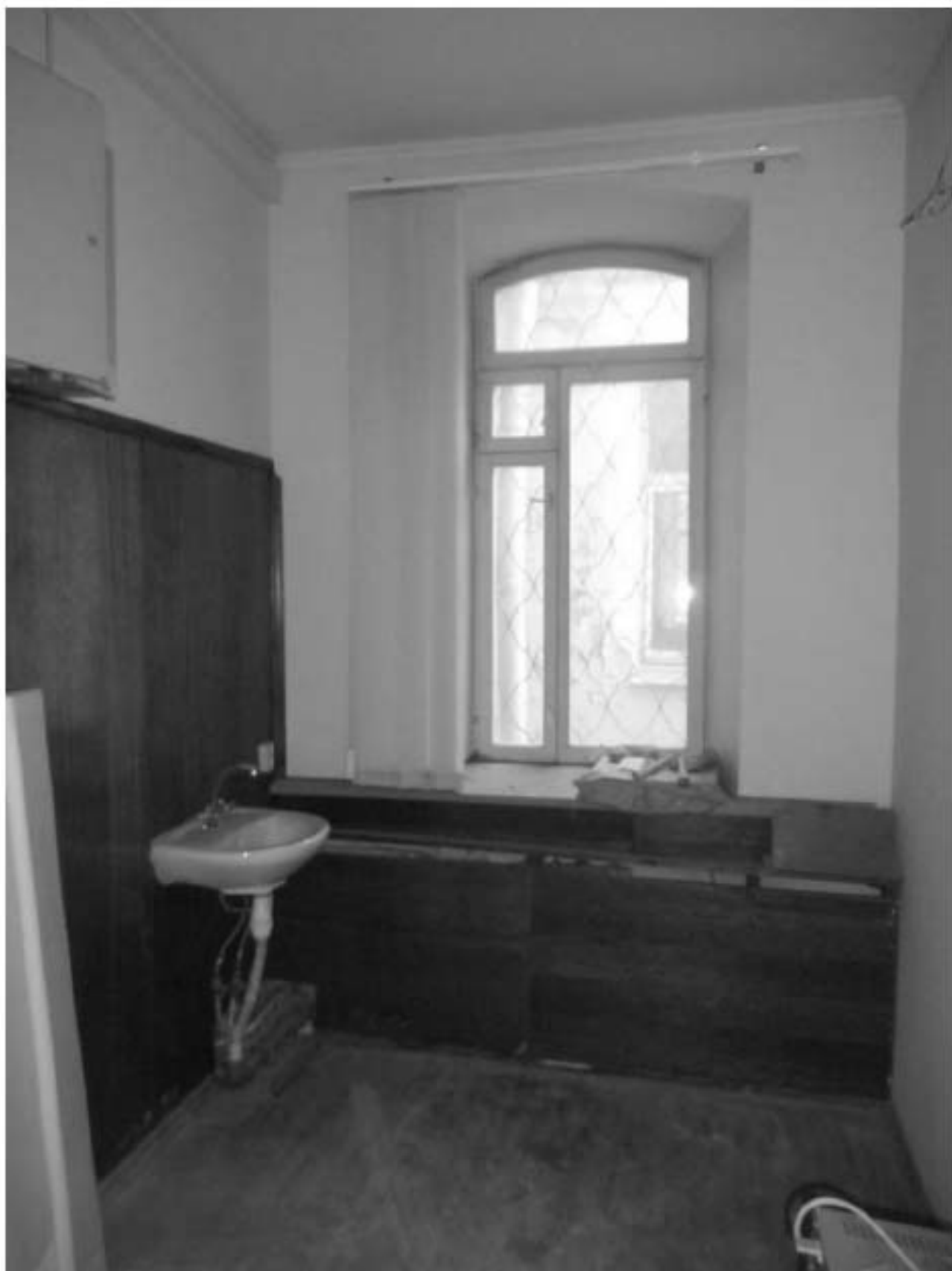
633. Этаж 3, помещение 17-Н. Комната 6,4 кв.м.
