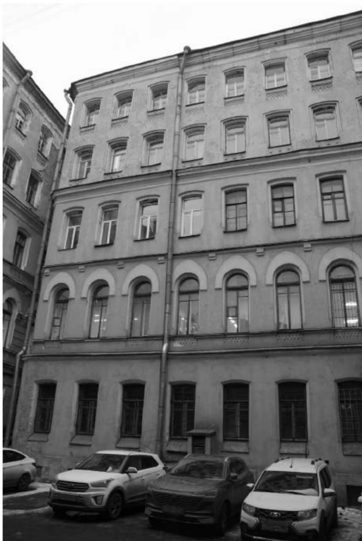
80. Вид дворового фасада.
