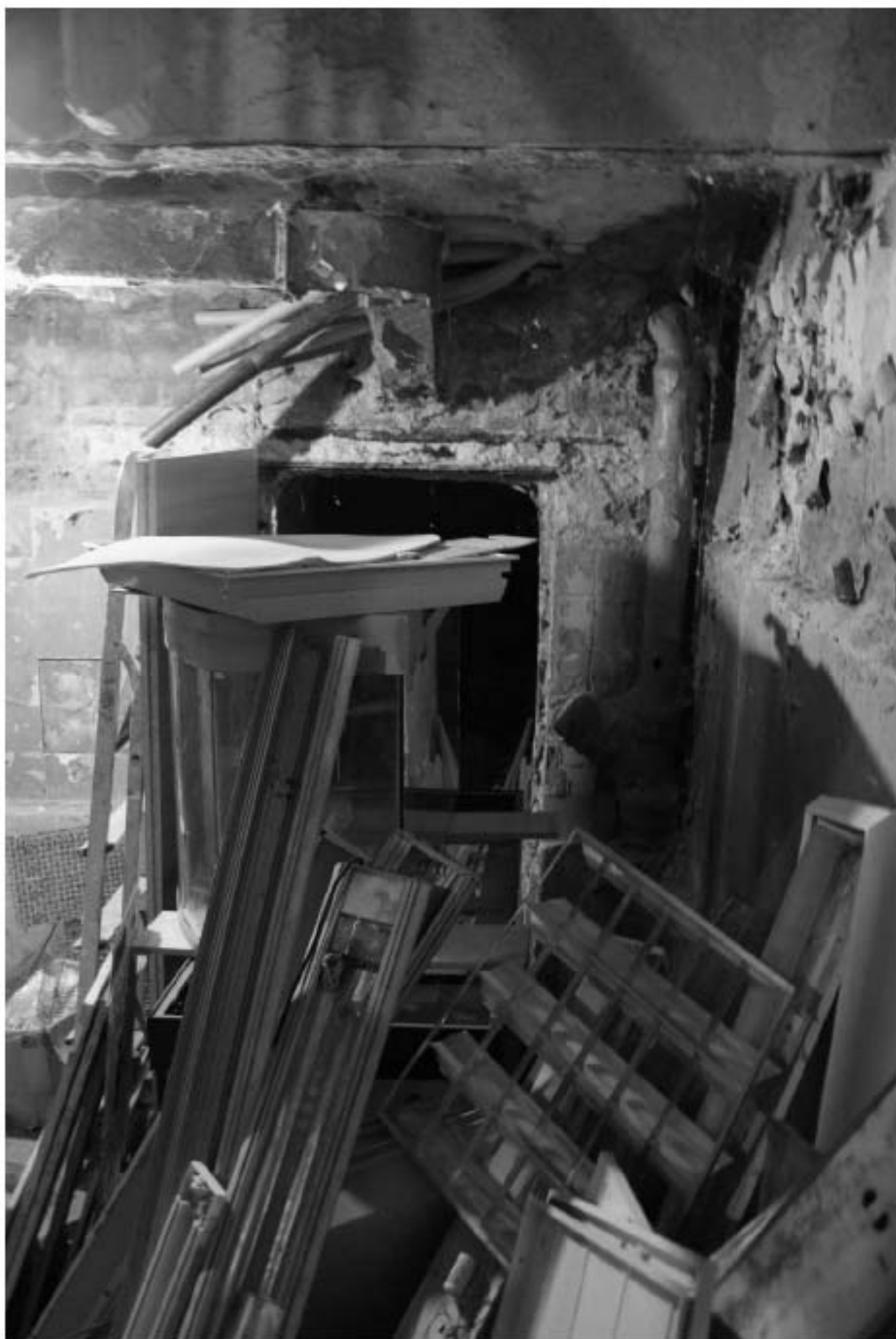
1021. Подвал. Вход в помещение 5-Н.
