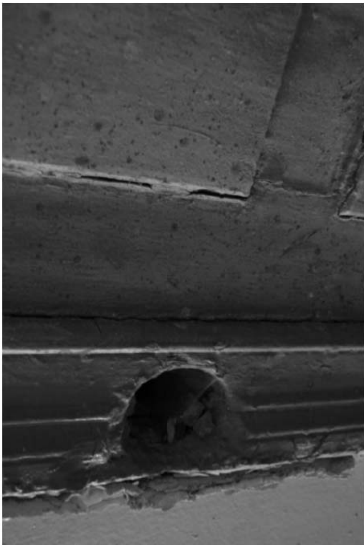
239. Лестница 4ЛК. Отверстие дверного звонка.
