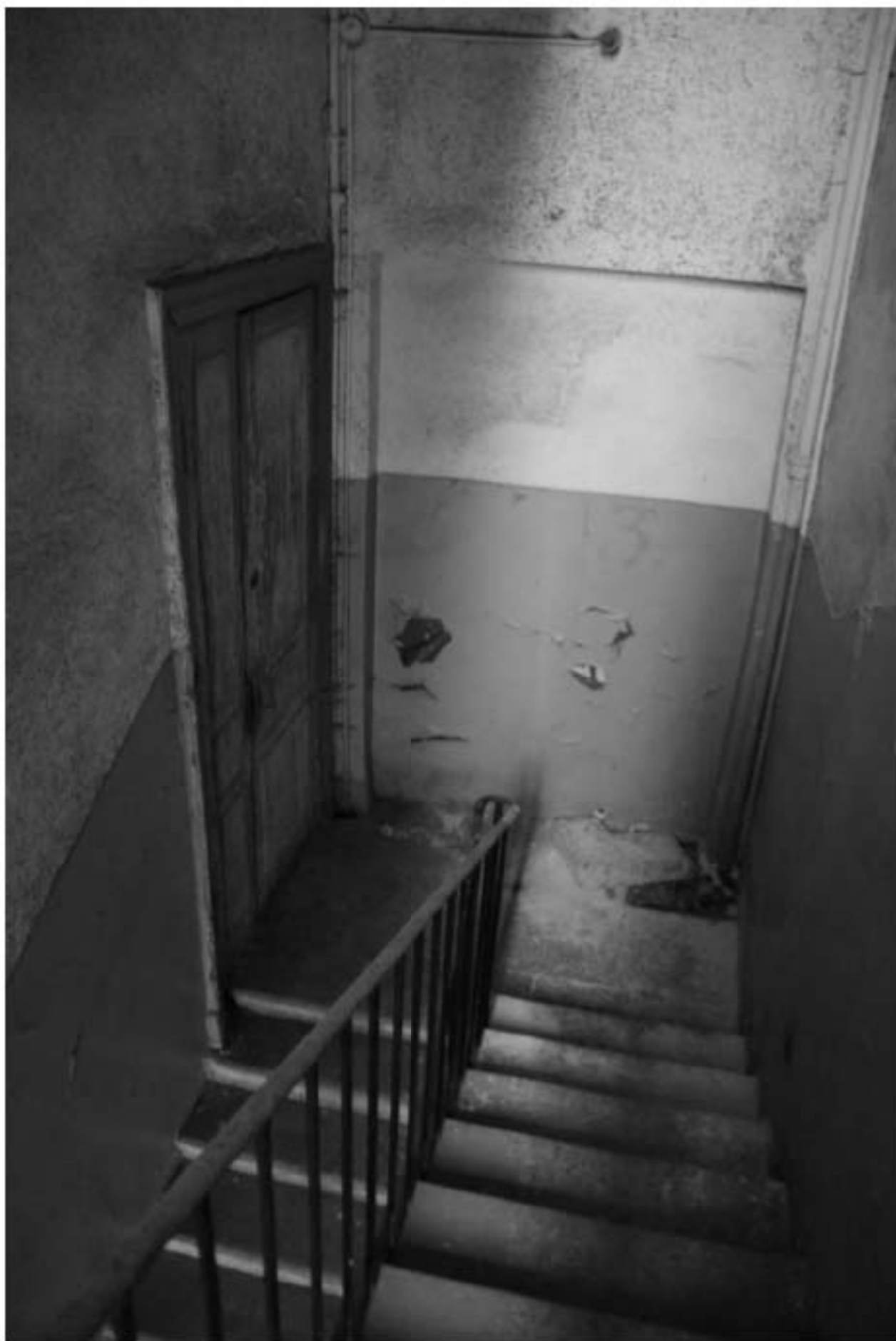
230. Лестница 4ЛК. Лестничная площадка 3 этажа.
