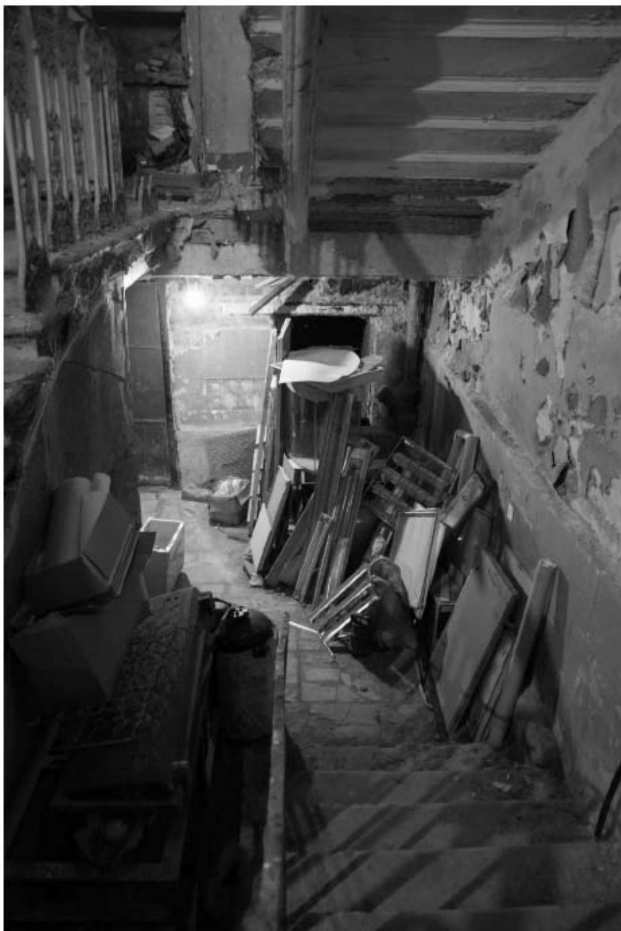
183. Лестница ЗЛК. Вход в подвал.
