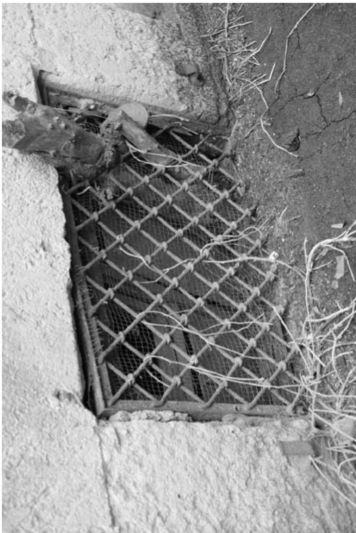
93. Фрагмент дворового фасада.
