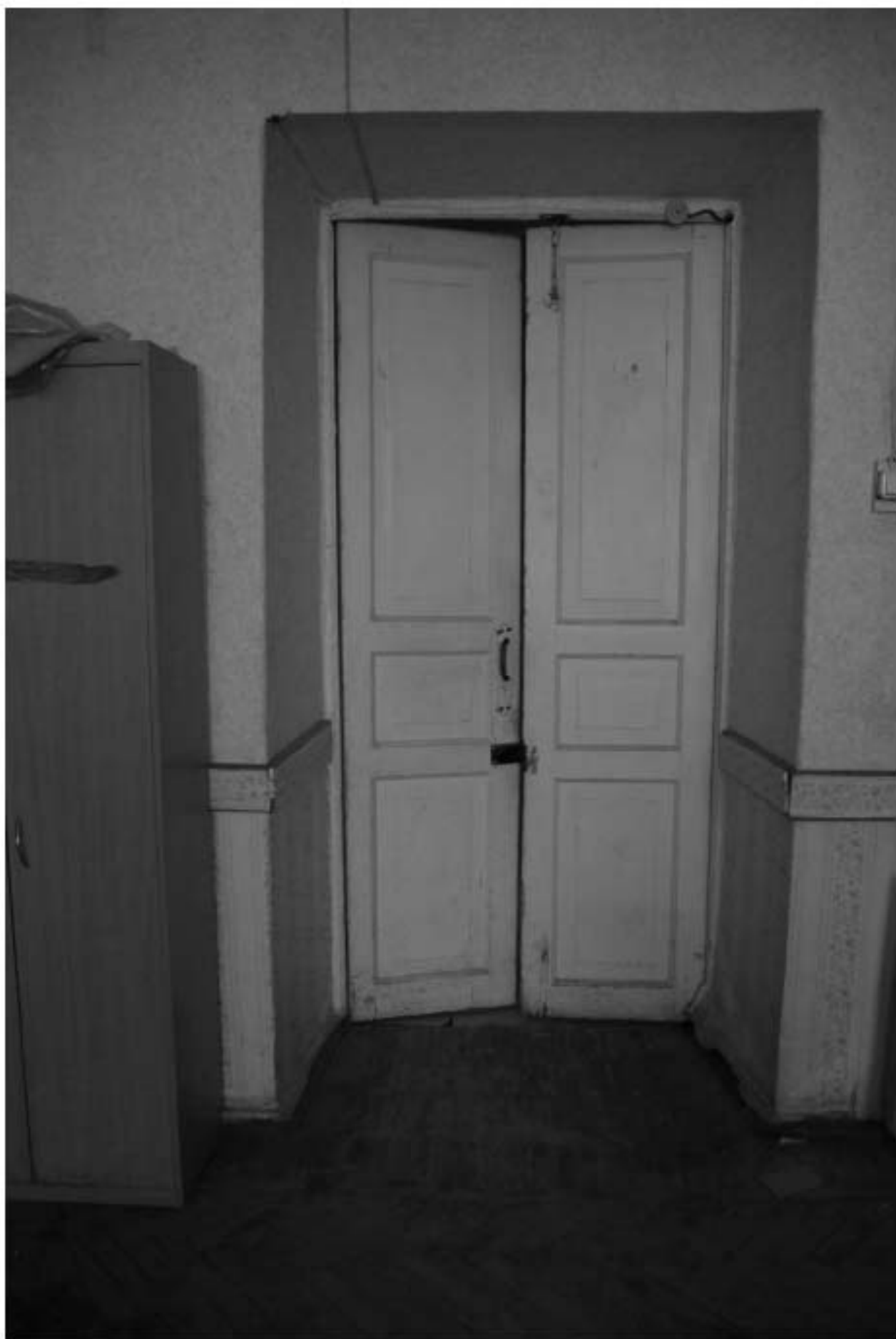
332. Этаж 1, помещение 15-Н. Входная дверь комнаты 25,1 кв.м.
