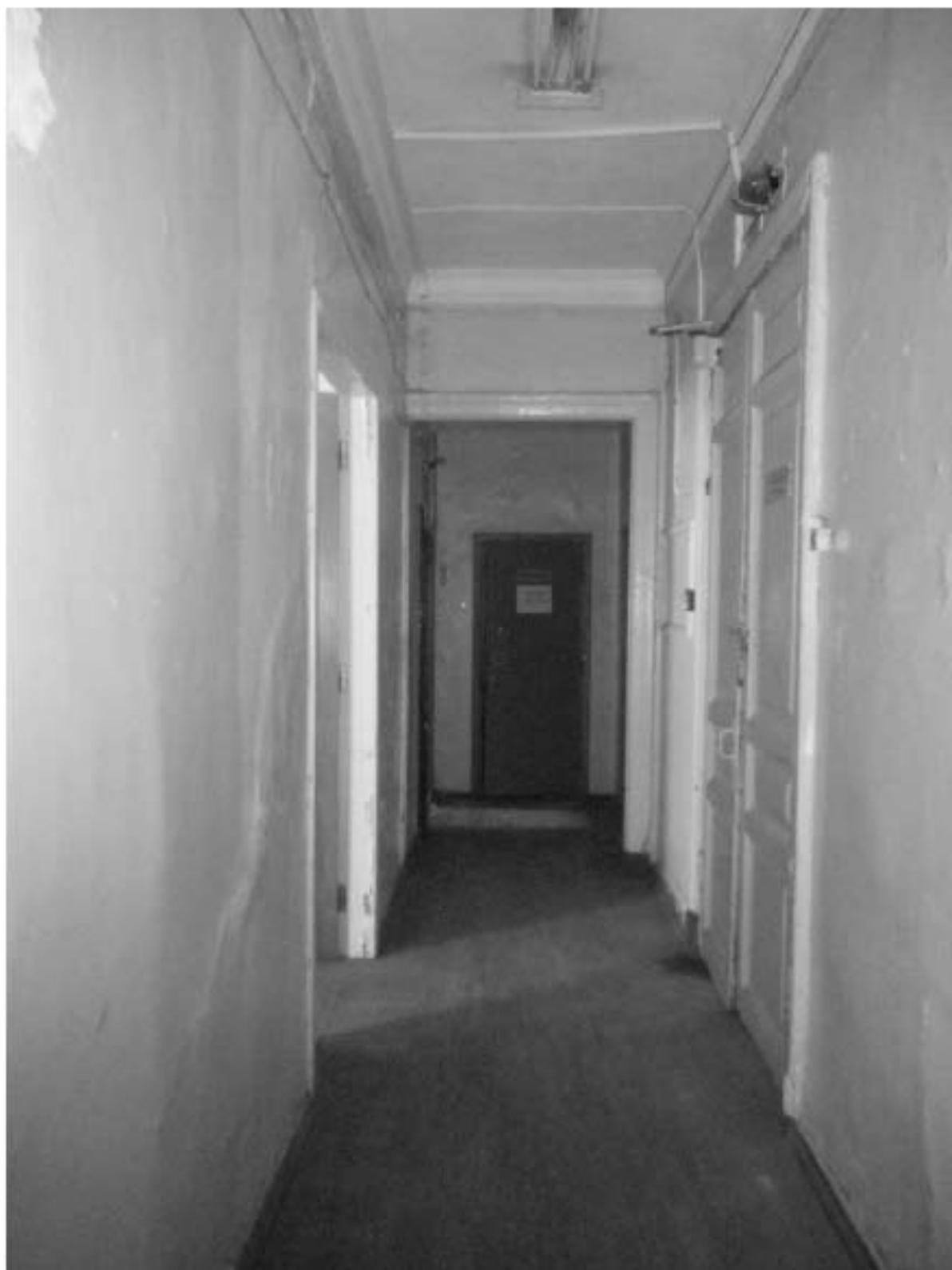
773. Этаж 4, помещение 40-Н. Вид коридора.
