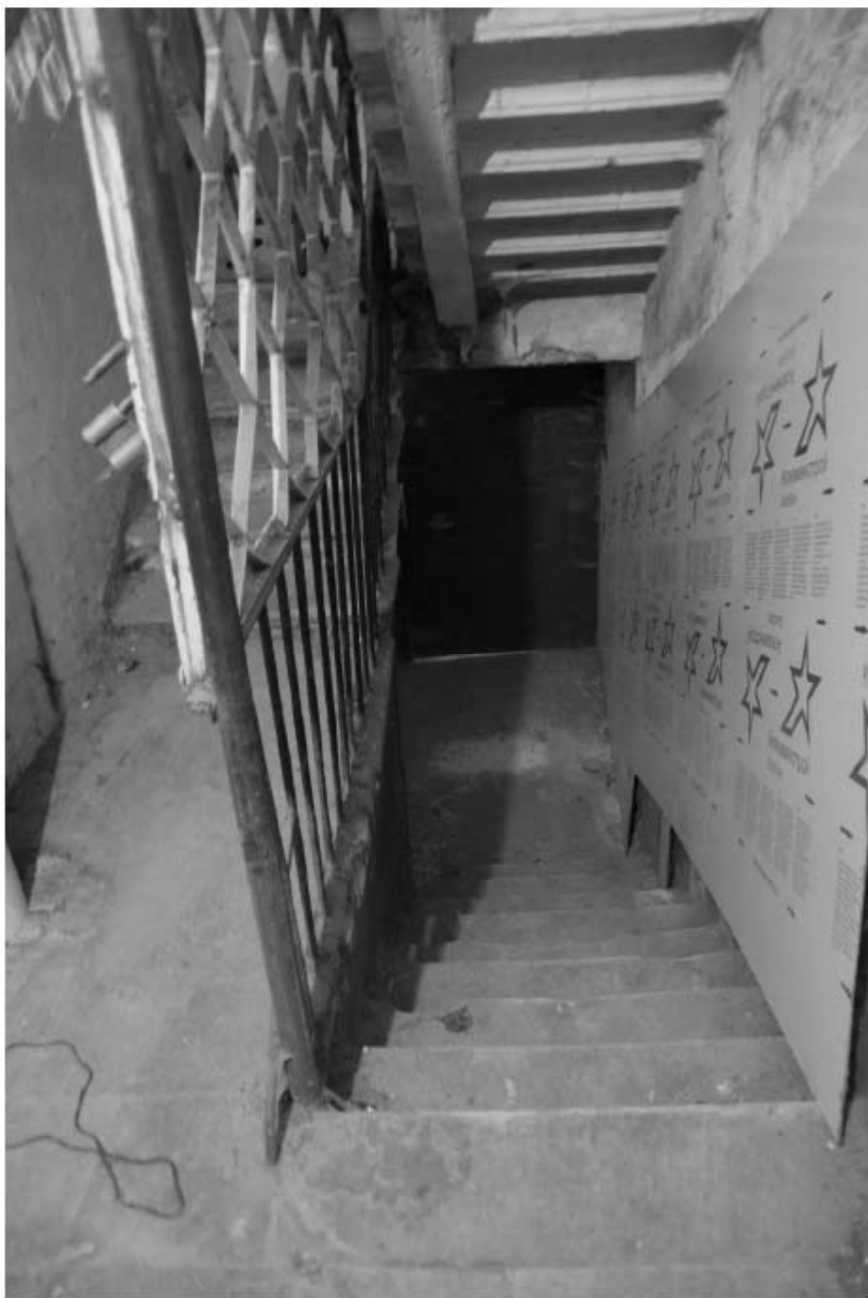
216. Лестница 4ЛК. Вход в подвал.
