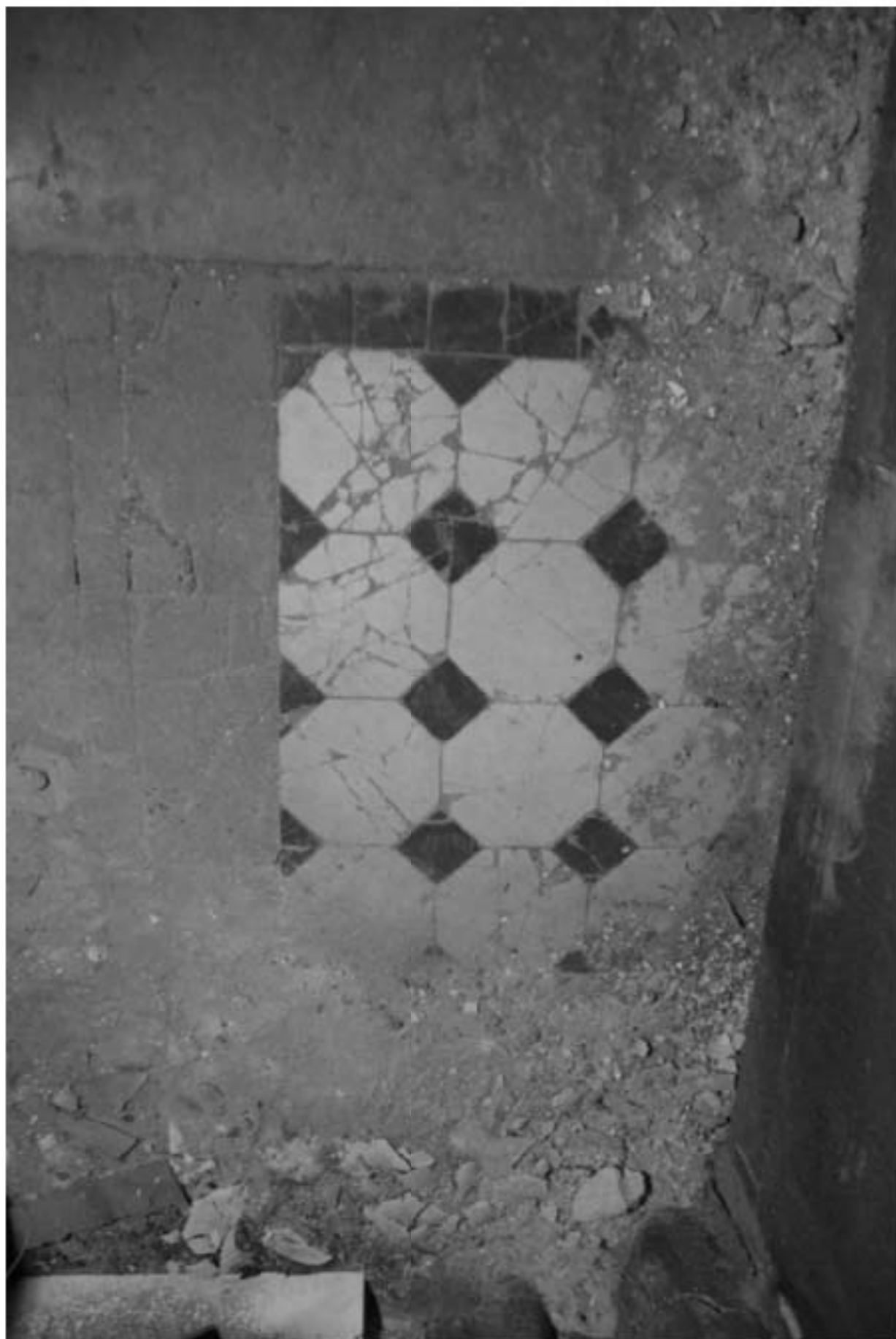
789. Лестница 3ЛК. Фрагмент покрытия лестничной площадки 1 этажа.
