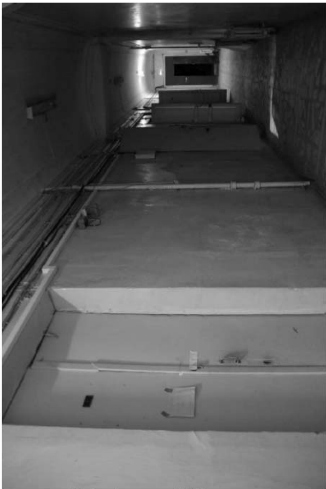
320. Этаж 1, помещение 15-Н. Вид коридора.
