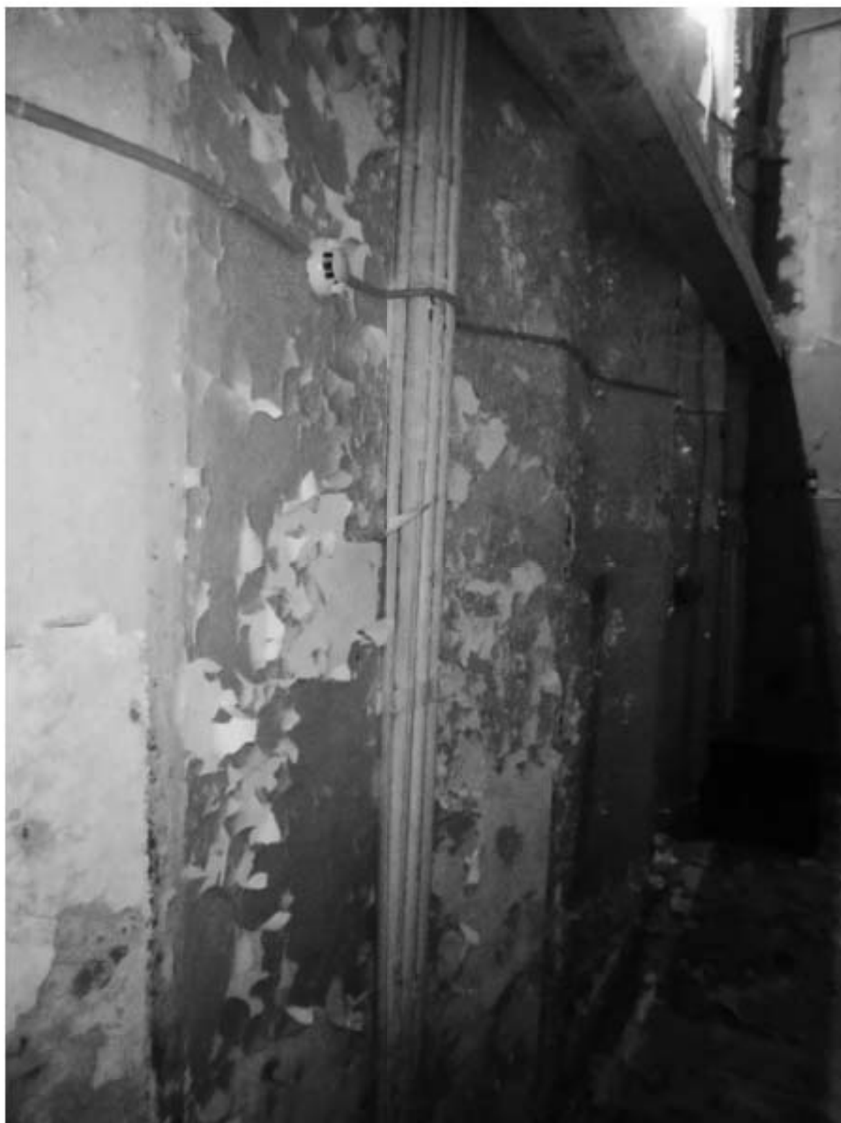
1002. Подвал, помещение 6-Н. Интерьер комнаты 57,8 кв.м.
