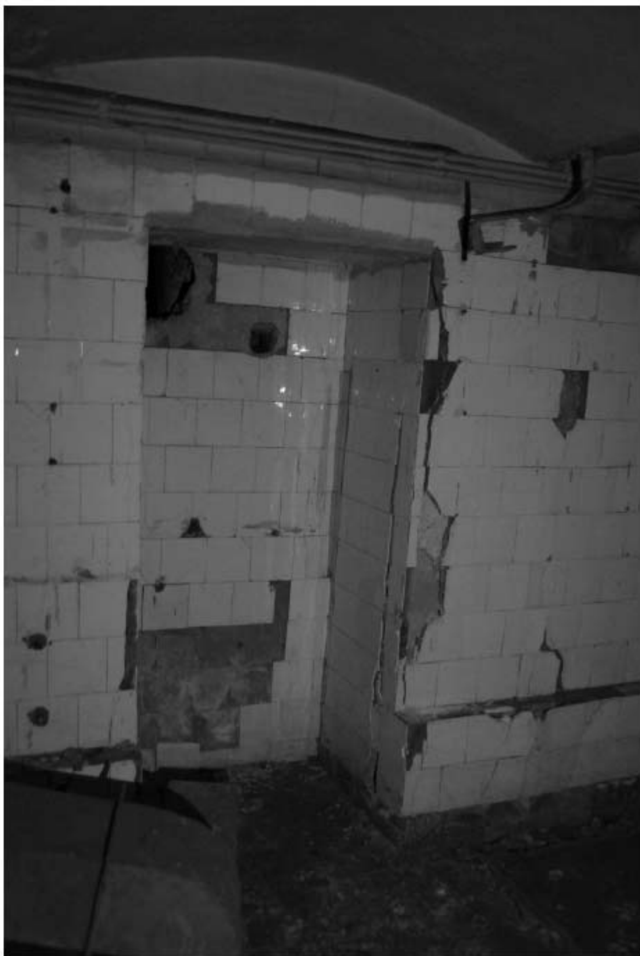
974. Подвал, помещение 6-Н. Интерьер комнаты 14,2 кв.м.
