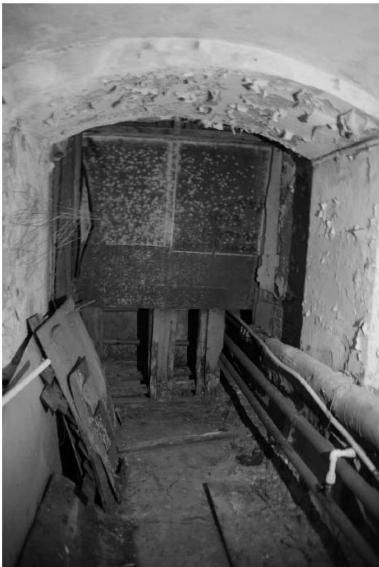
950. Подвал. Интерьер помещения 29-Н.
