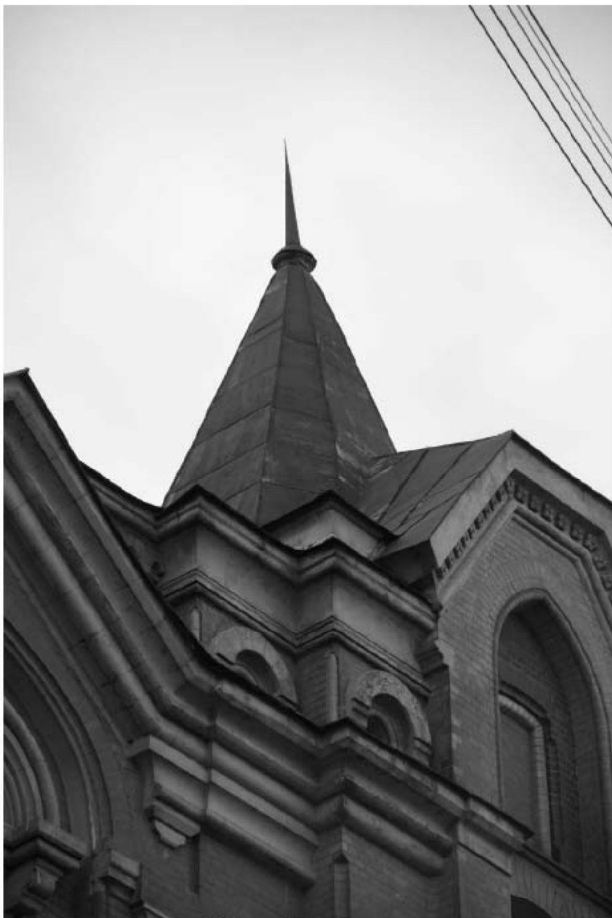
18. Вид на башенку кровли.
