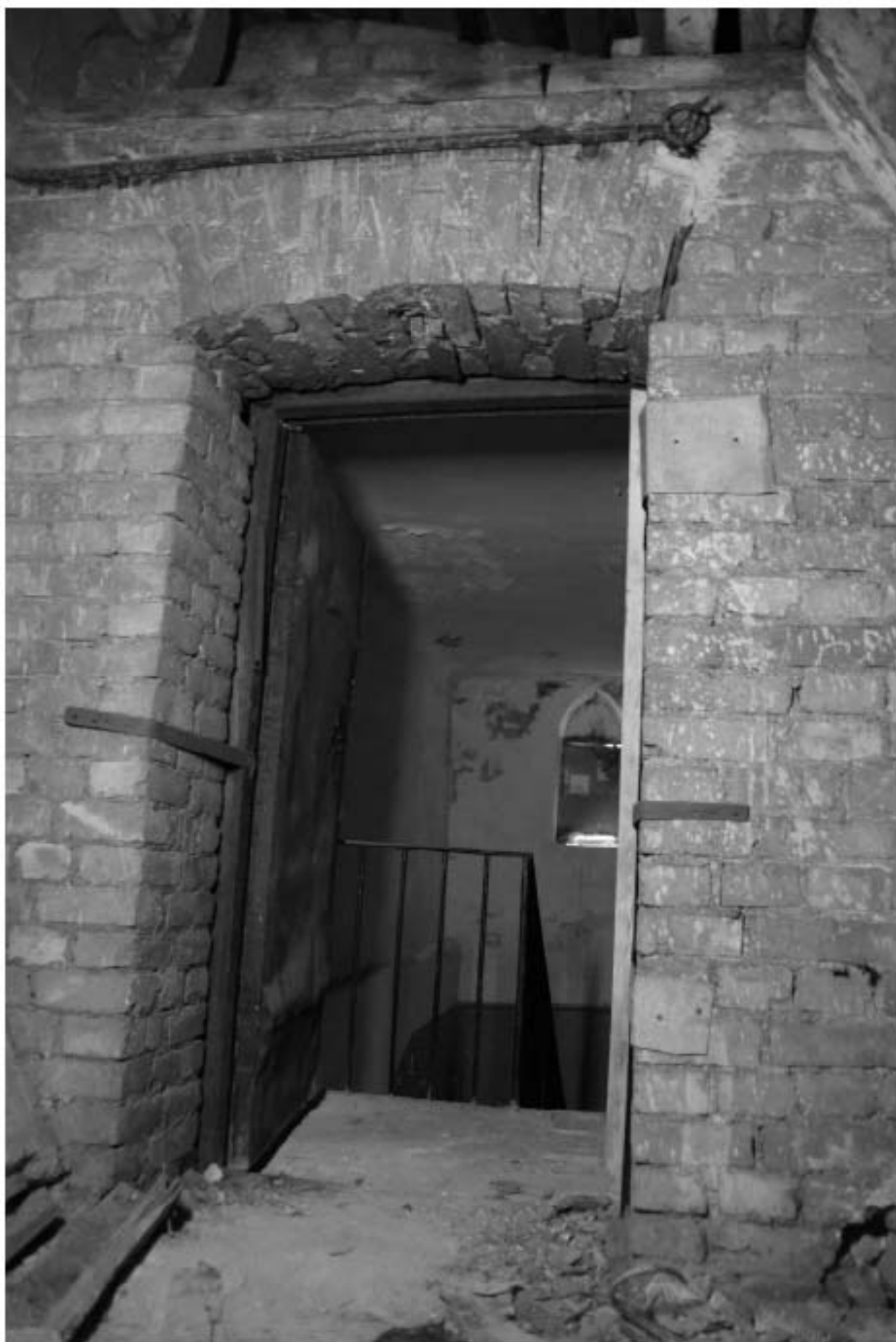
880. Чердак, выход на лестницу 2ЛК.
