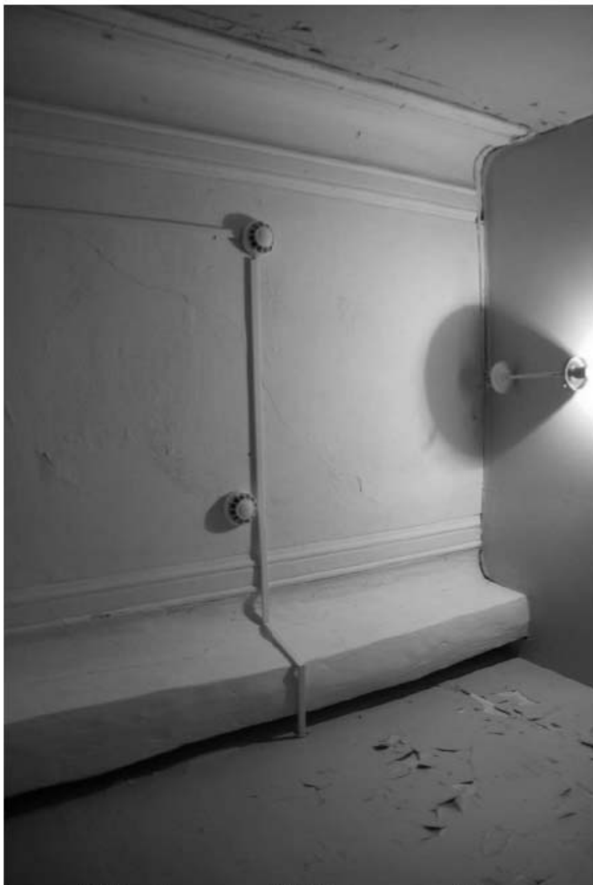
249. Этаж 1, помещение 20-Н. Потолок комнаты 3,6 кв.м.
