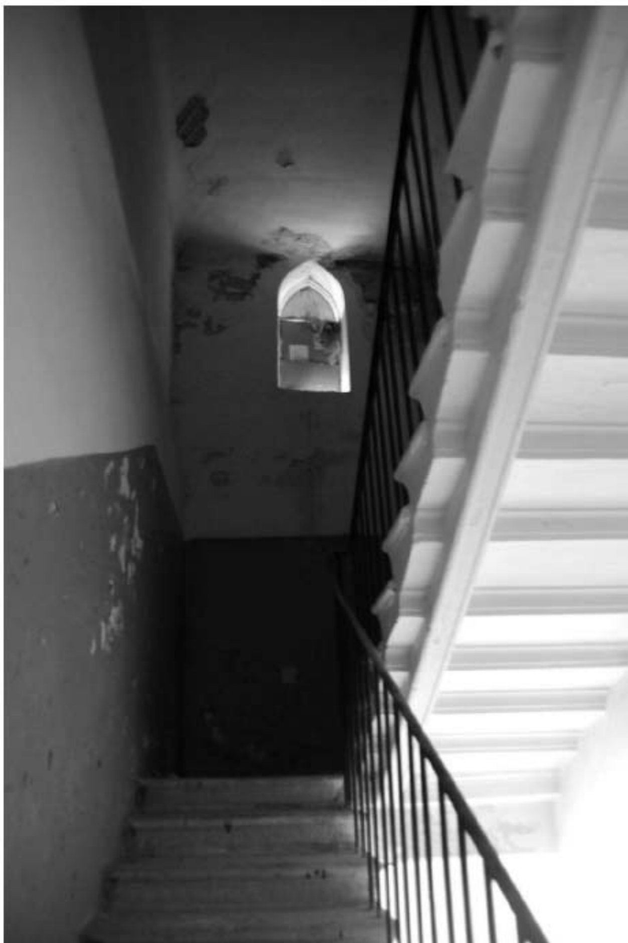
1680. Лестница 2ЛК. Лестничная площадка между 5 этажом и чердаком.
