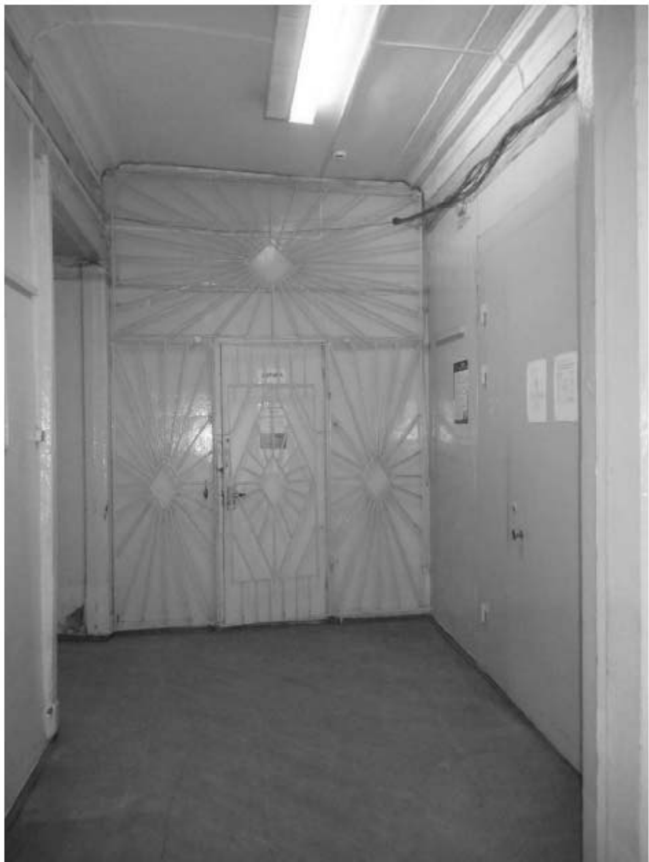
726. Этаж 4, помещение 40-Н. Вид комнаты 9 кв.м.
