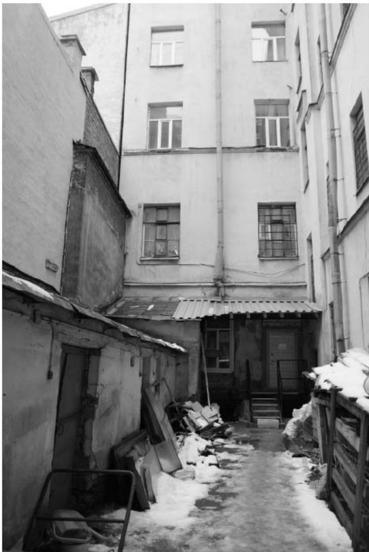
105. Вид второго двора.
