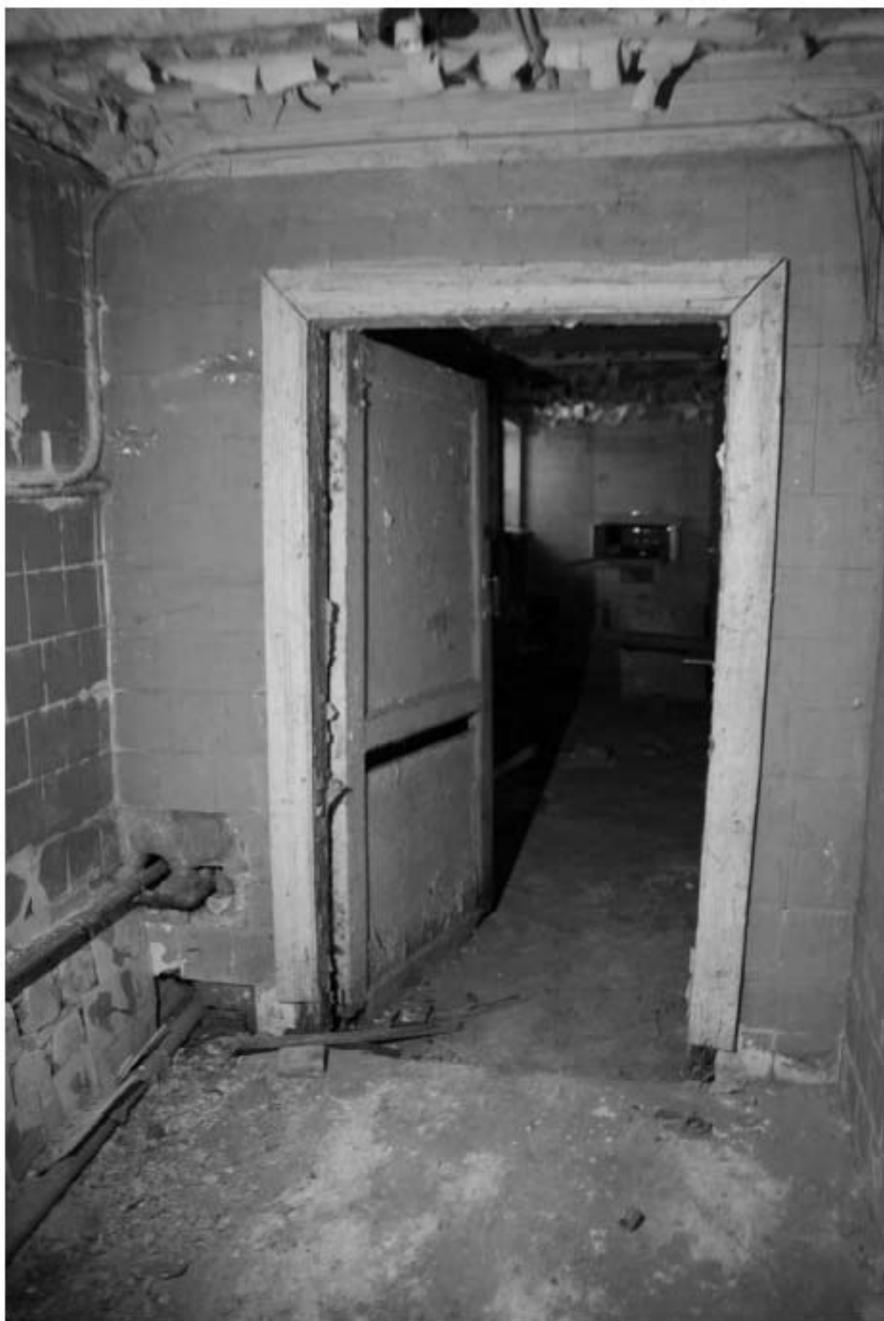
966. Подвал, помещение 6-Н. Вид в коридор из комнаты 4,7 кв.м.
