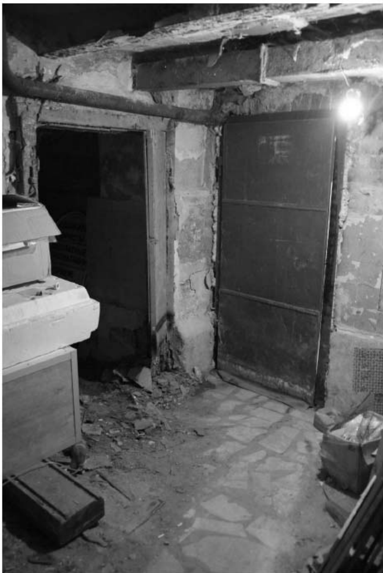
1020. Вход в подвал с лестницы ЗЛК.
