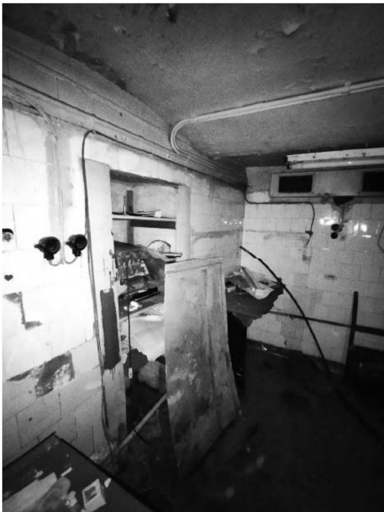
993. Подвал, помещение 6-Н. Интерьер комнаты 9,9 кв.м.
