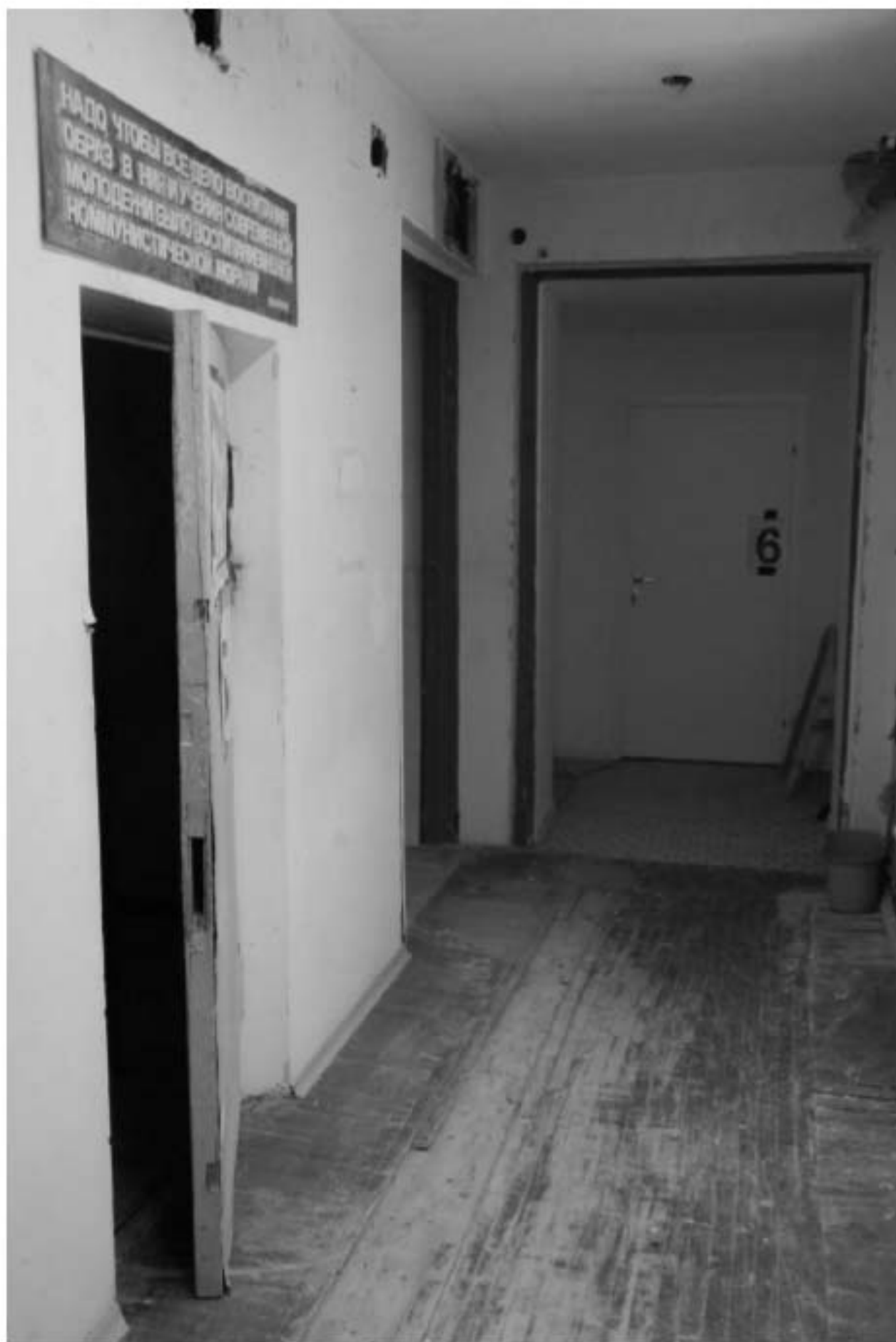
821. Этаж 5, помещение 19-Н. Вид коридора.
