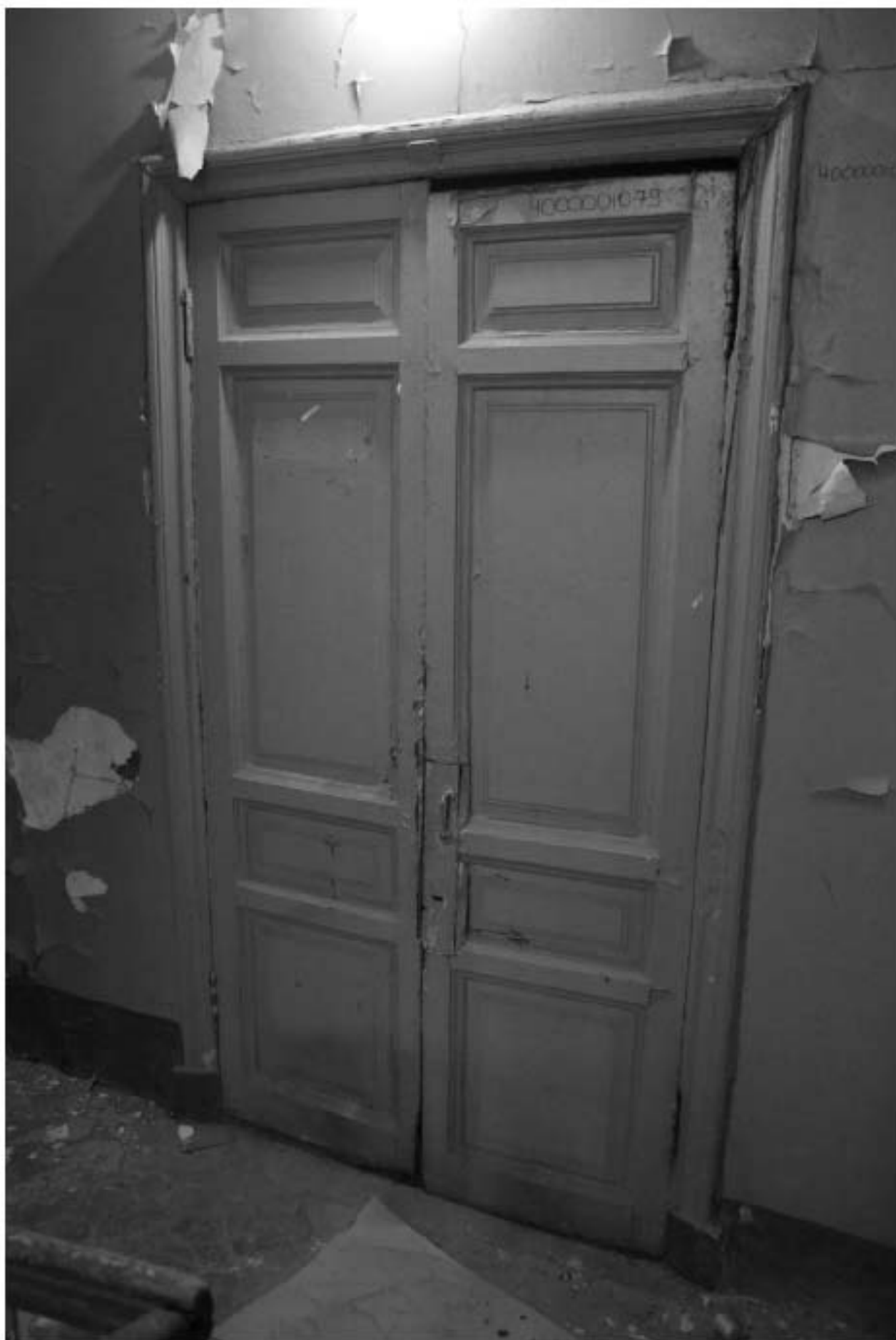
200. Лестница ЗЛК. Входная дверь лестничной площадки 3 этажа.
