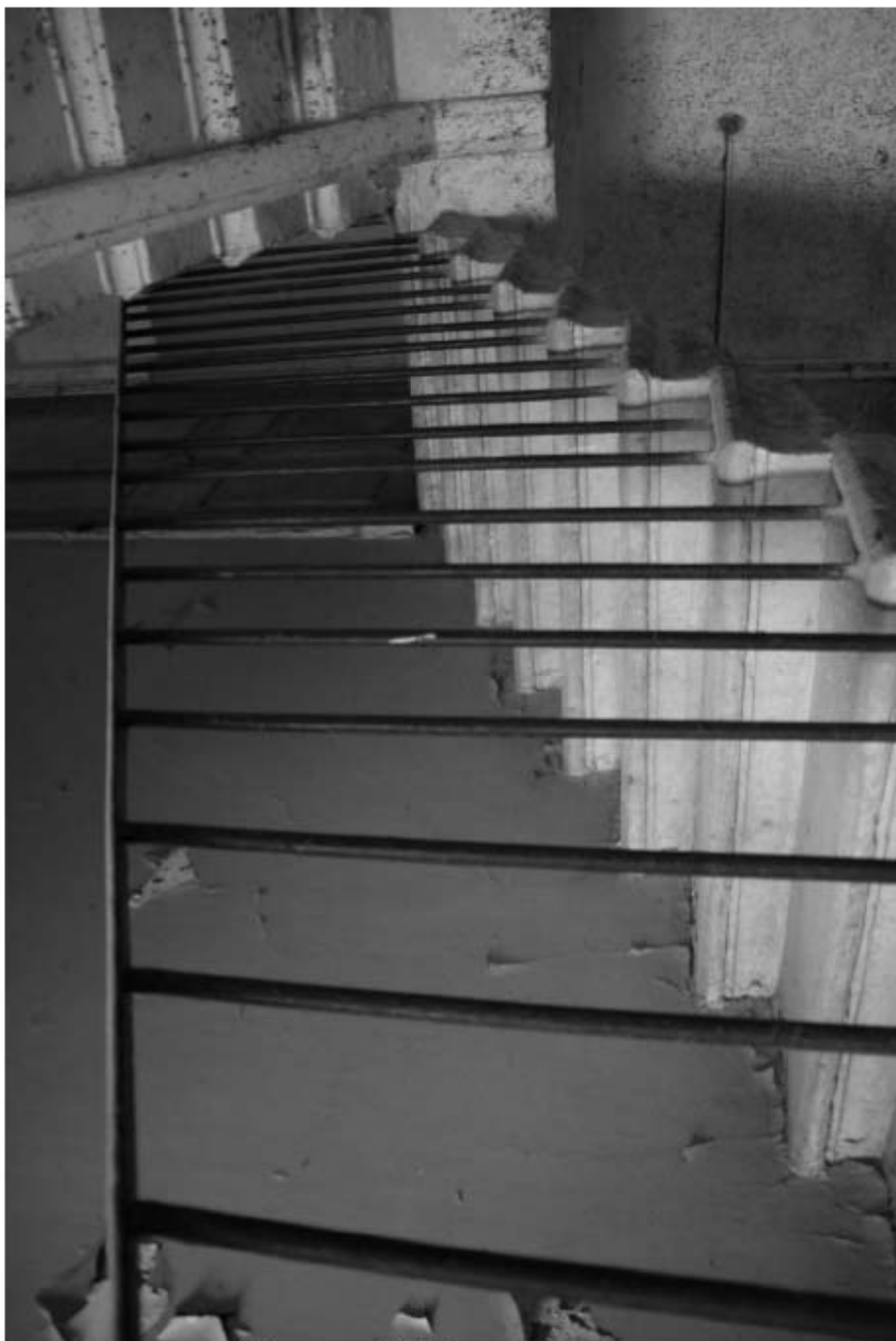
234. Лестница 4ЛК. Ограждение лестницы.
