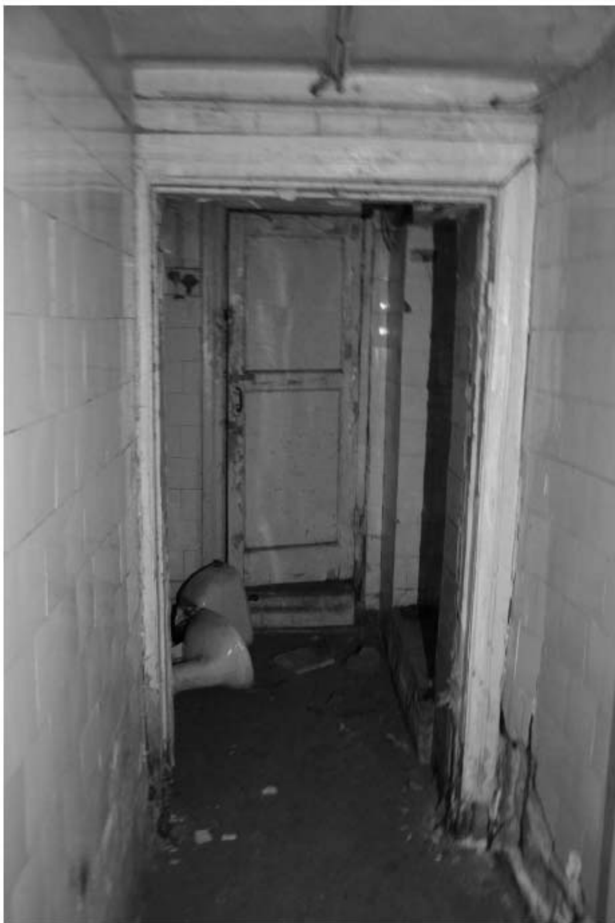
986. Подвал, помещение 6-Н. Вид на вход в комнату 5,9 кв.м.
