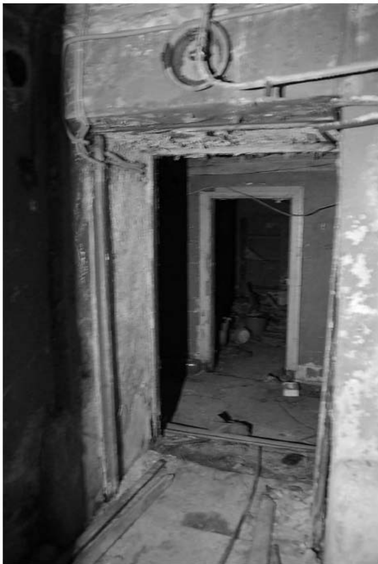
963. Подвал, помещение 6-Н. Вход в комнату 2,2 кв. м.
