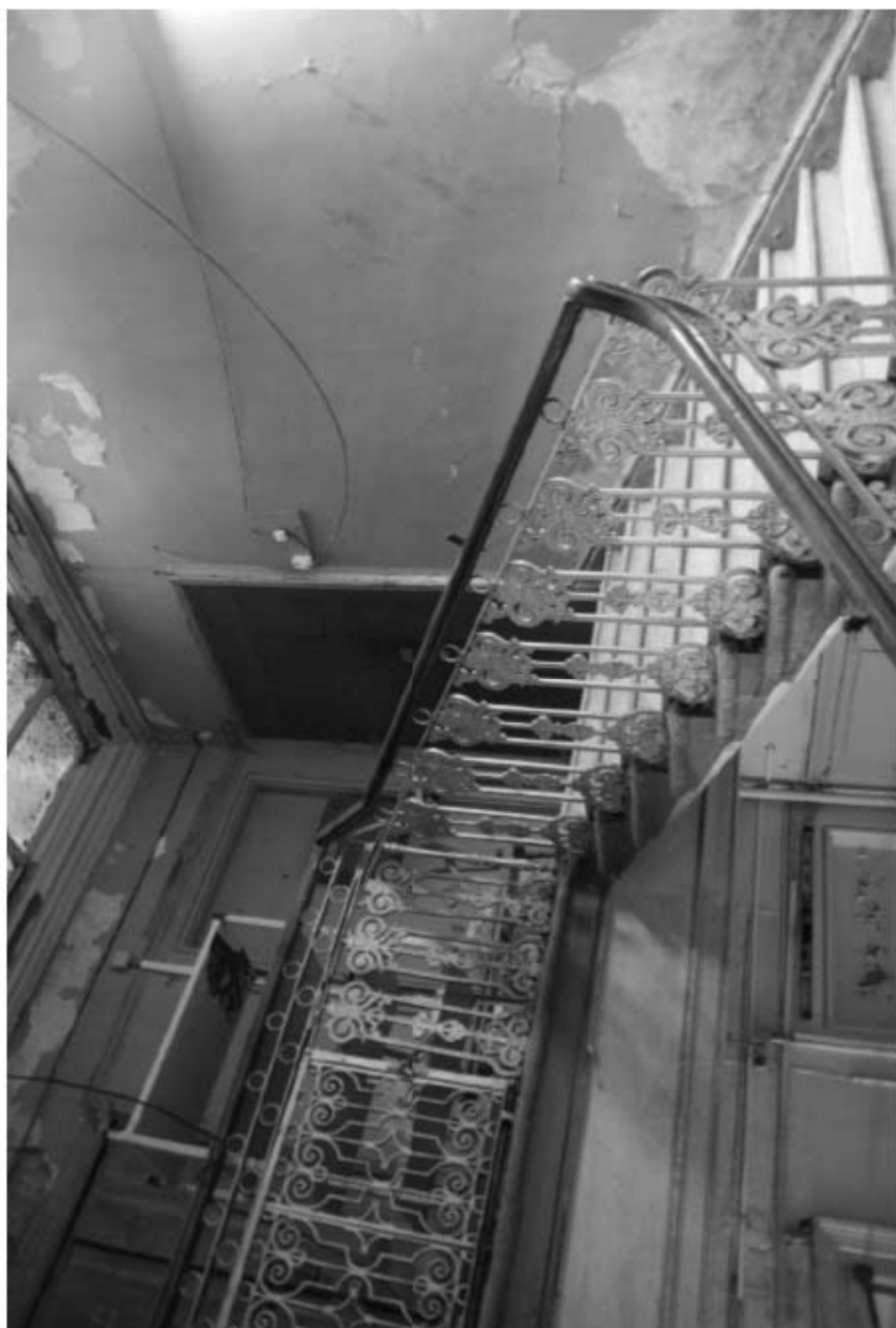
150. Вид на лестничную площадку 5 этажа.
