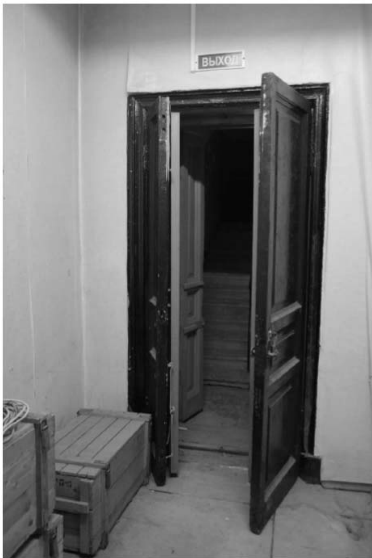
805. Этаж 5, помещение 31-Н. Дверь выхода на лестницу 2ЛК.
