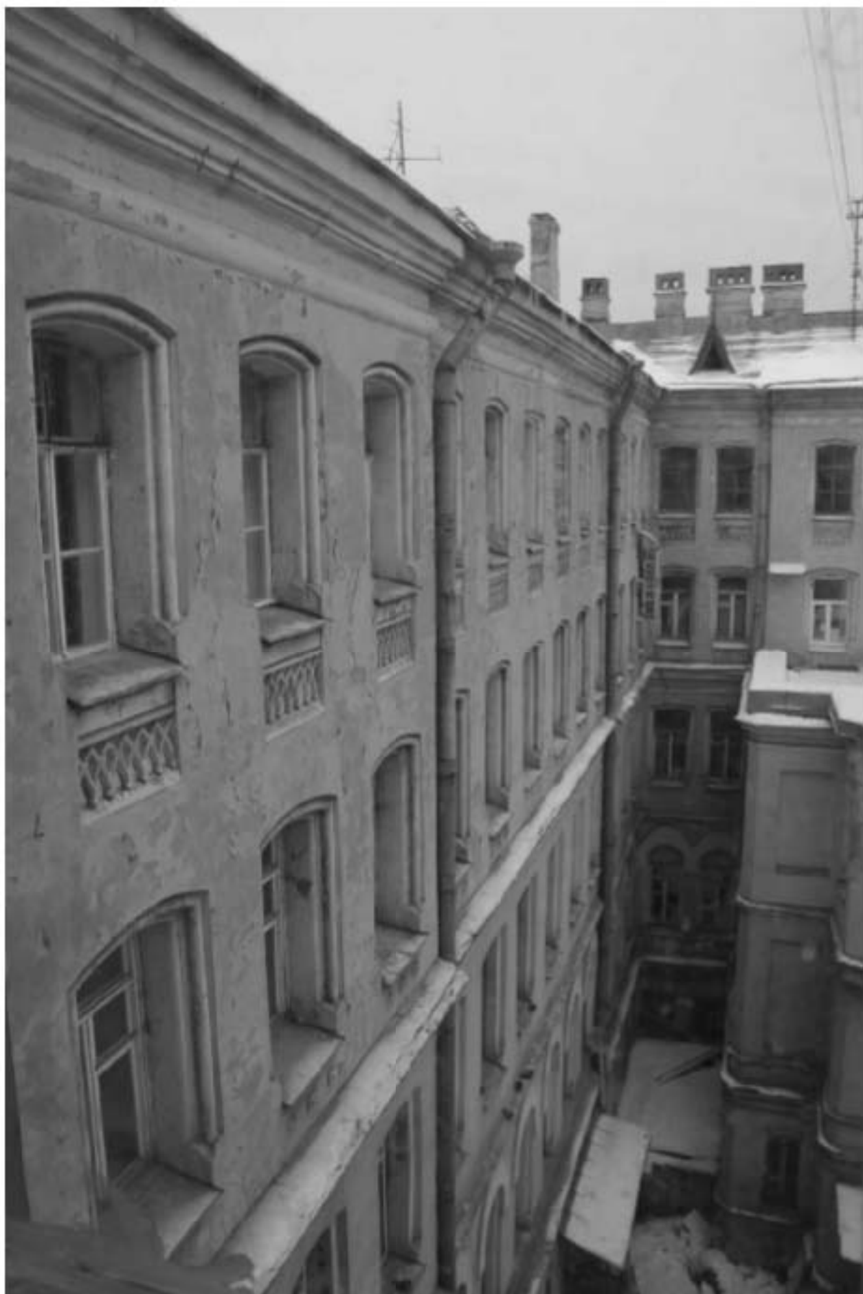
75. Вид на дворовые фасады.
