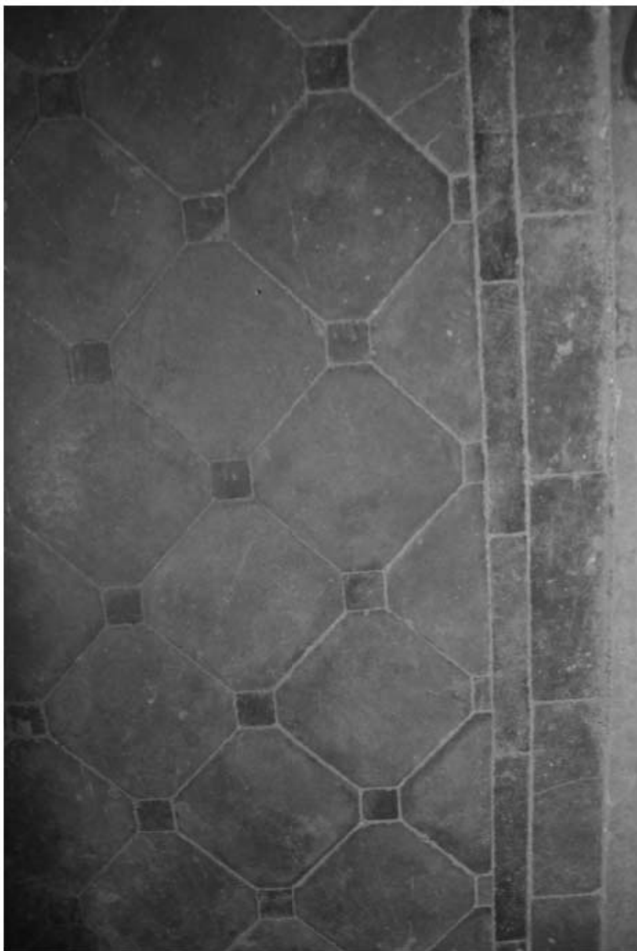
210. Лестница 3ЛК. Покрытие лестничной площадки.
