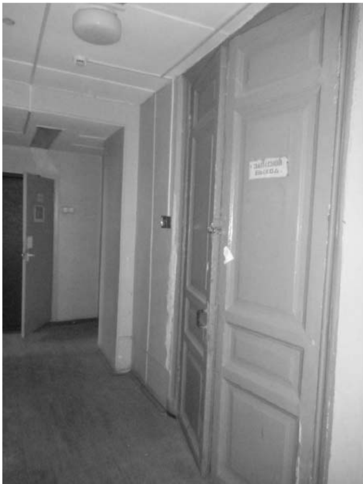
694. Этаж 3, помещение 17-Н. Дверь на лестницу ЗЛК.
