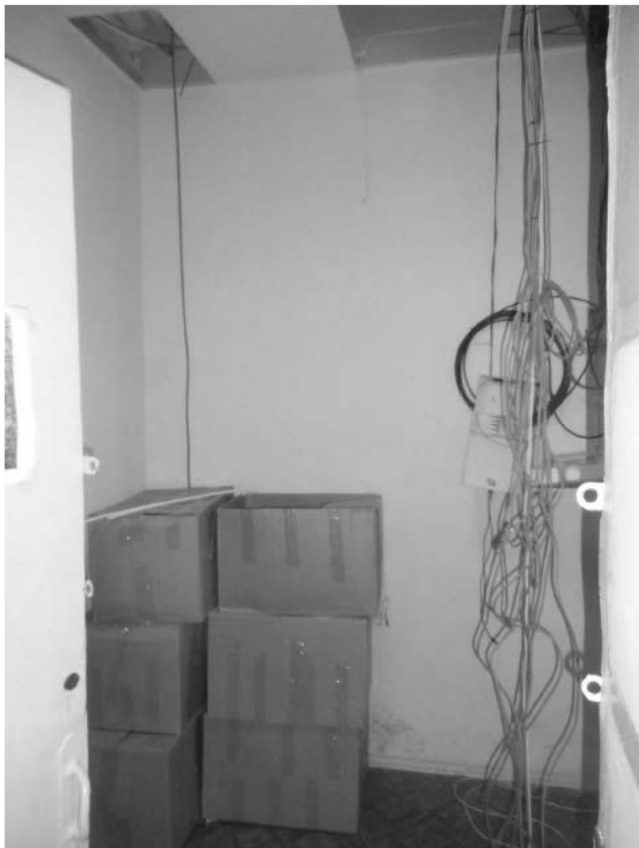
728. Этаж 4, помещение 40-Н. Вход в комнату 4,5 кв.м.
