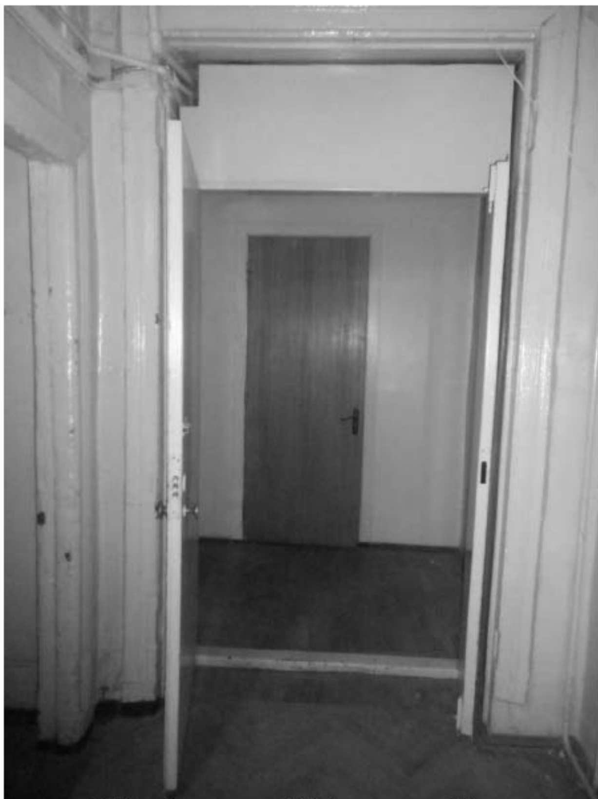
664. Этаж 3, помещение 17-Н. Вход в комнату 3,0 кв.м.
