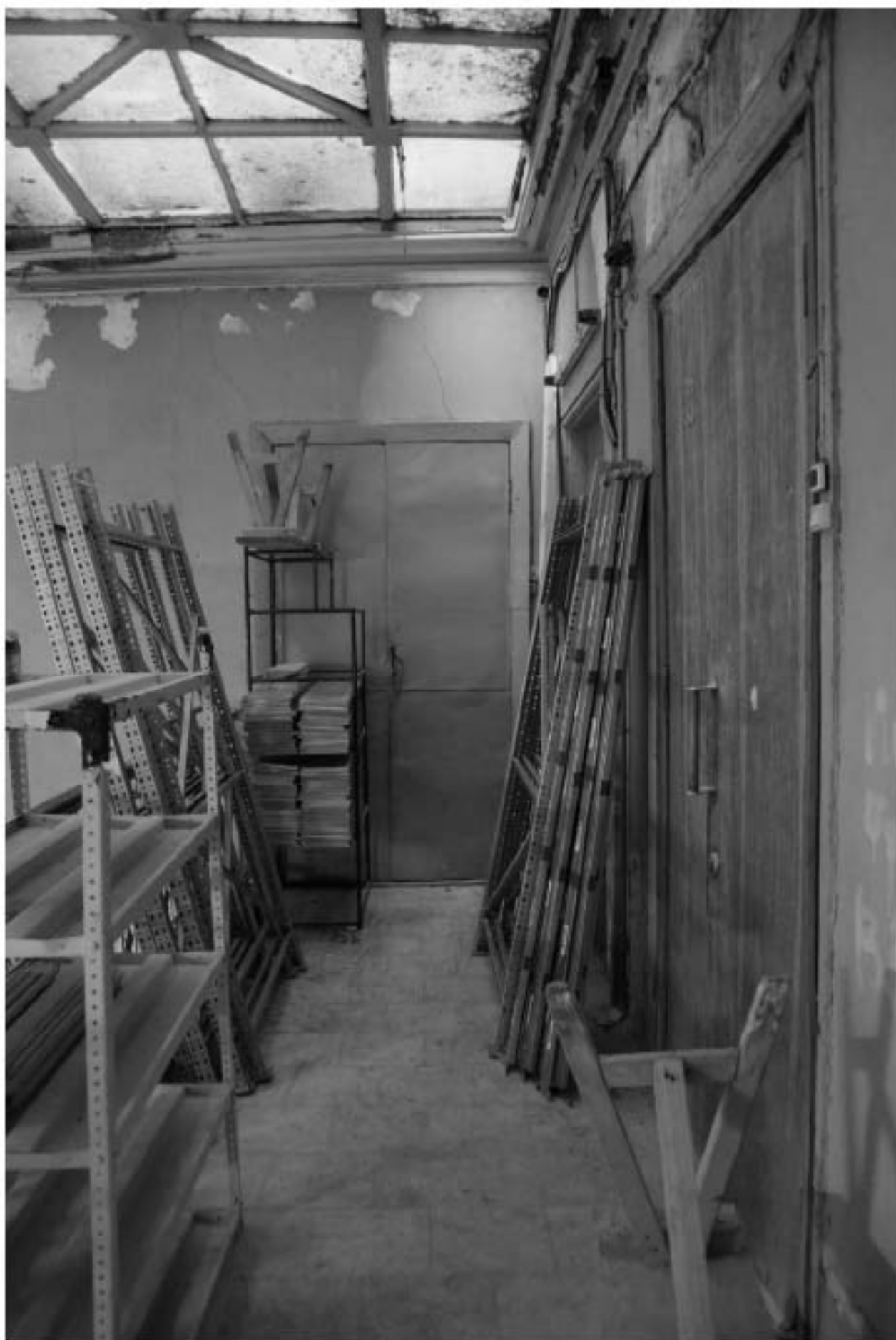
157. Лестничная площадка 5 этажа.
