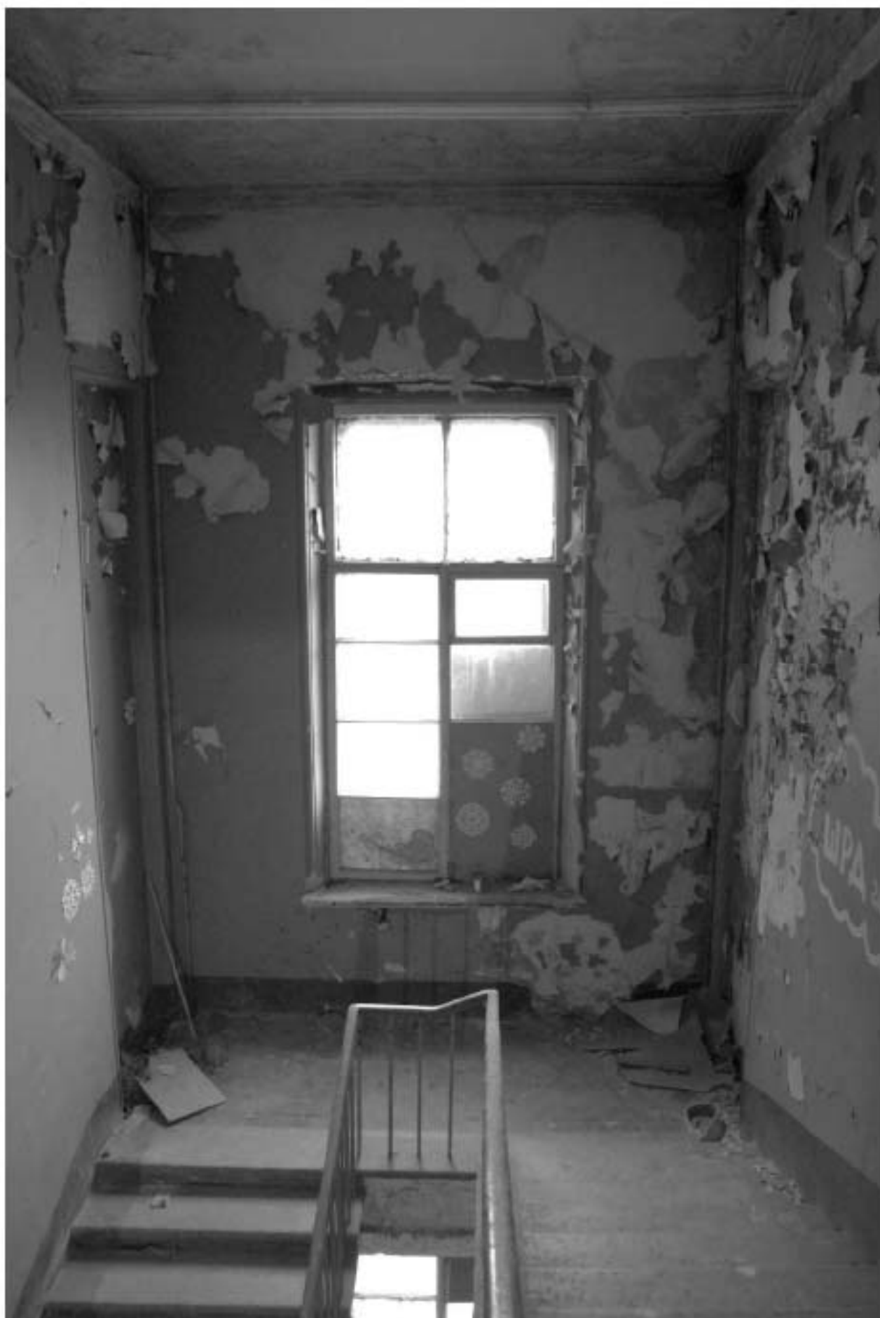
209. Лестница ЗЛК. Лестничная площадка между 4 и 5 этажами.
