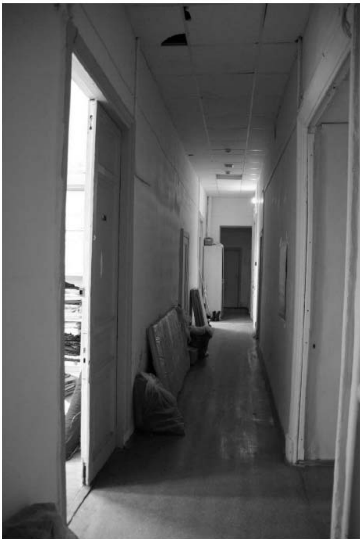
559. Этаж 2, помещение 16-Н. Вид коридора.
