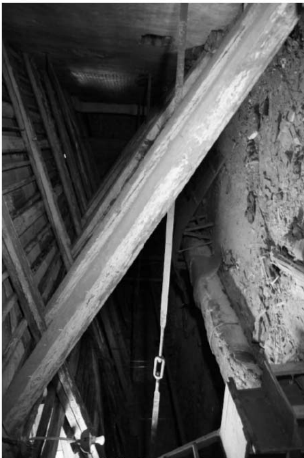
846а. Этаж 5, интерьер чердака.
