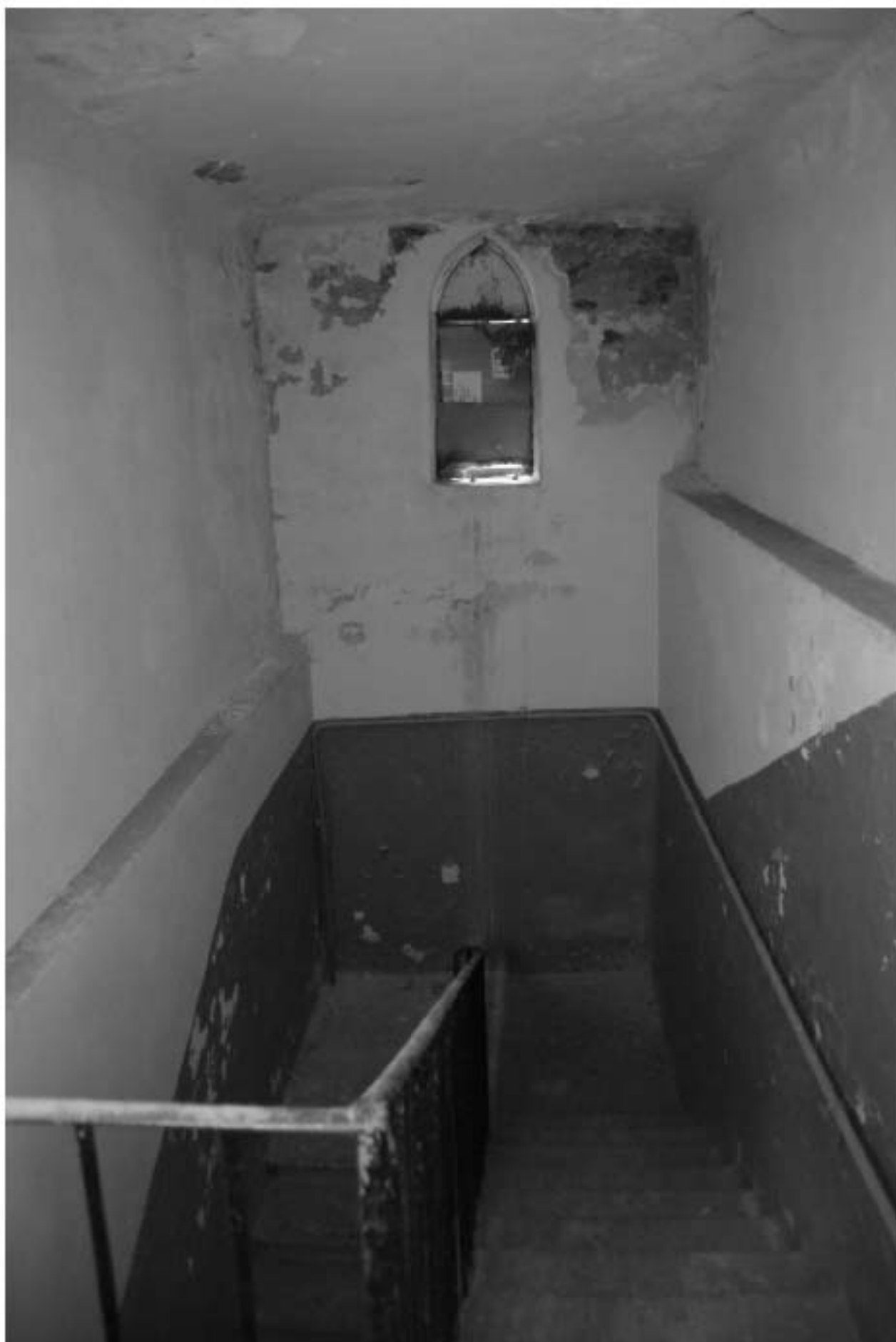
1781. Лестница 2ЛК. Лестничная площадка между 5 этажом и чердаком.
