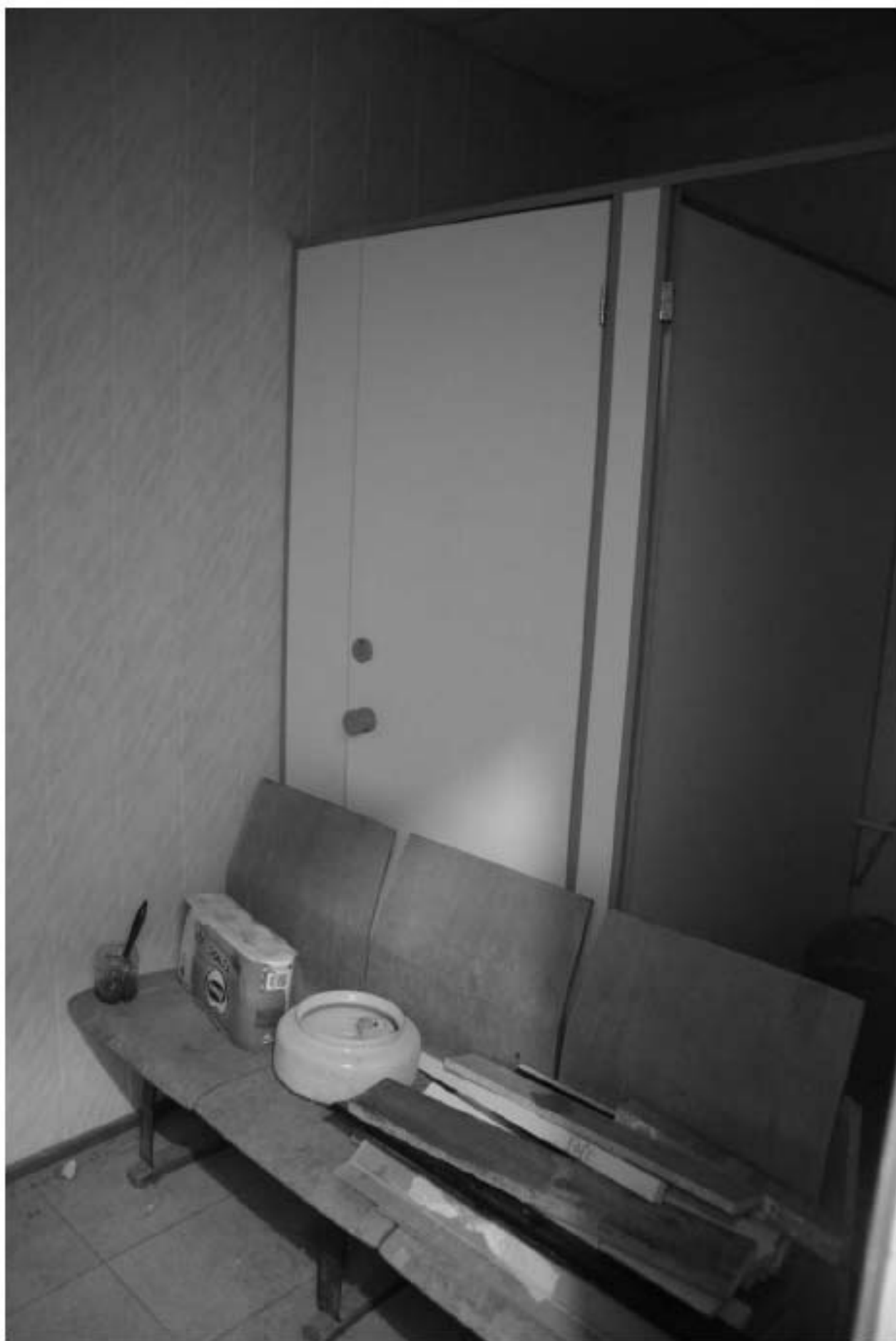
385. Этаж 1, помещение 15-Н. Интерьер душевой.
