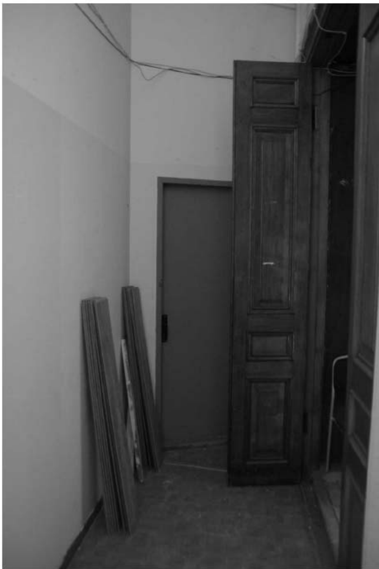
406. Этаж 2, помещение 26-Н. Коридор.
