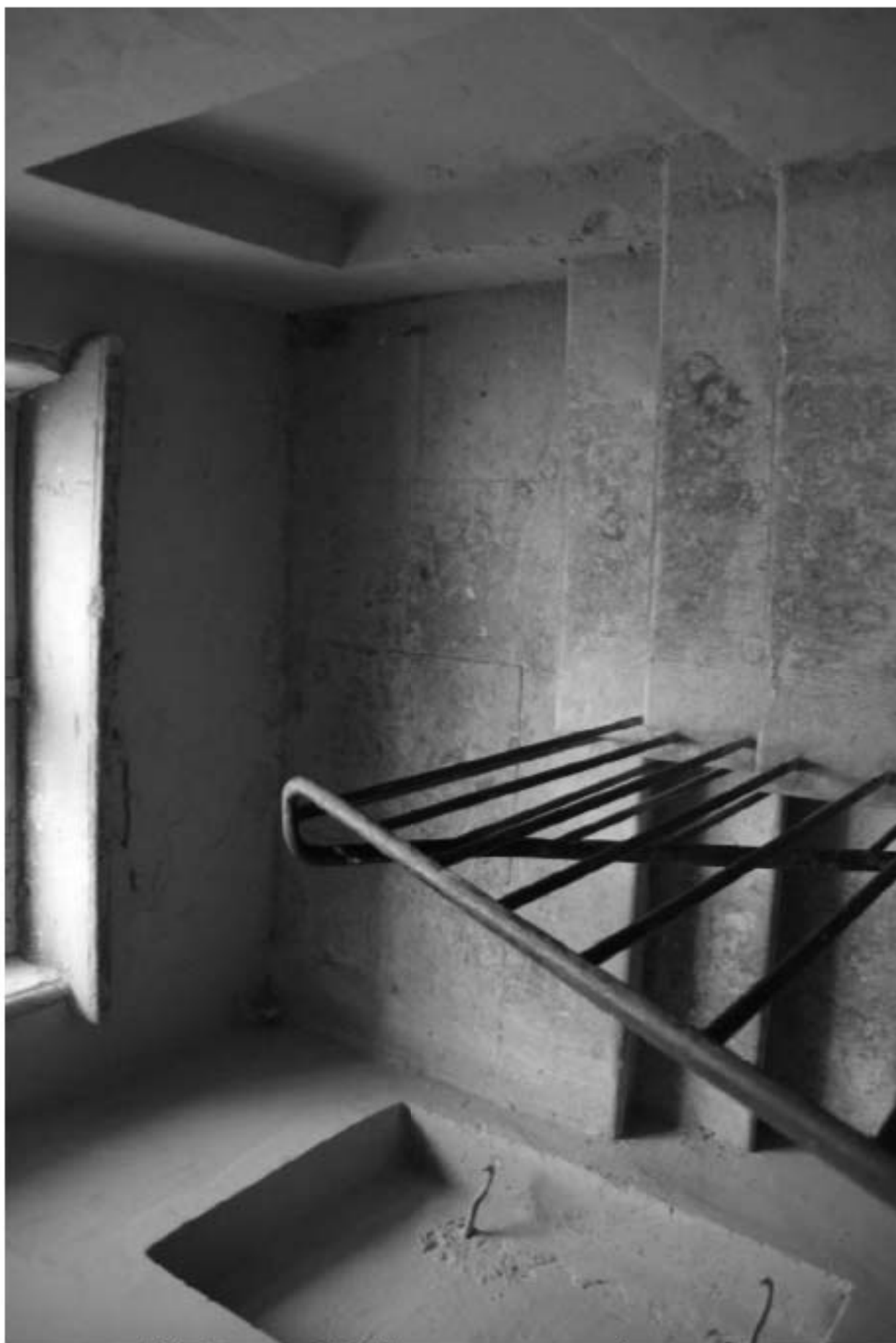
468. Лестница 2ЛК. Покрытие лестничной площадки.
