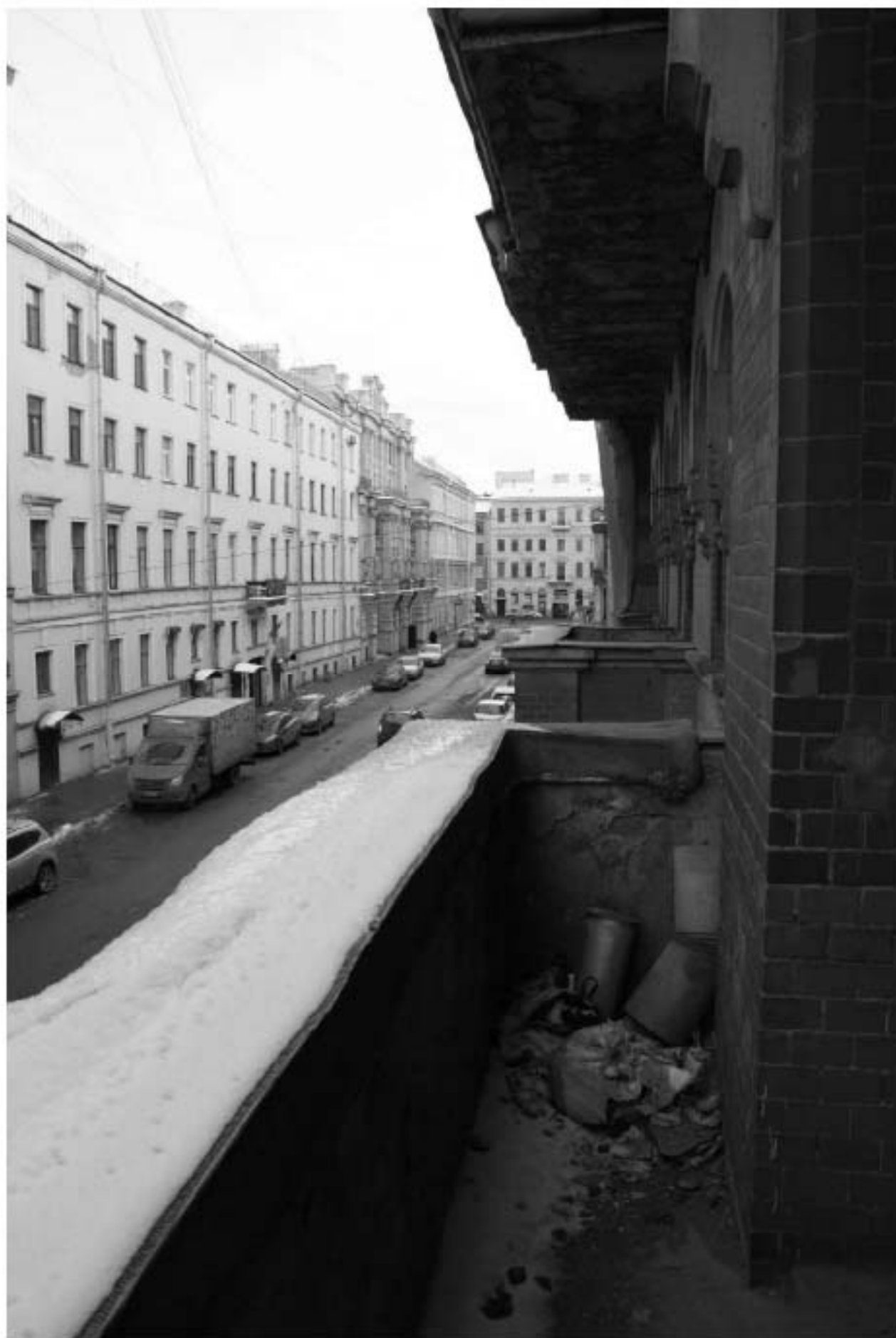
479. Этаж 2, помещение 30-Н. Балкон.
