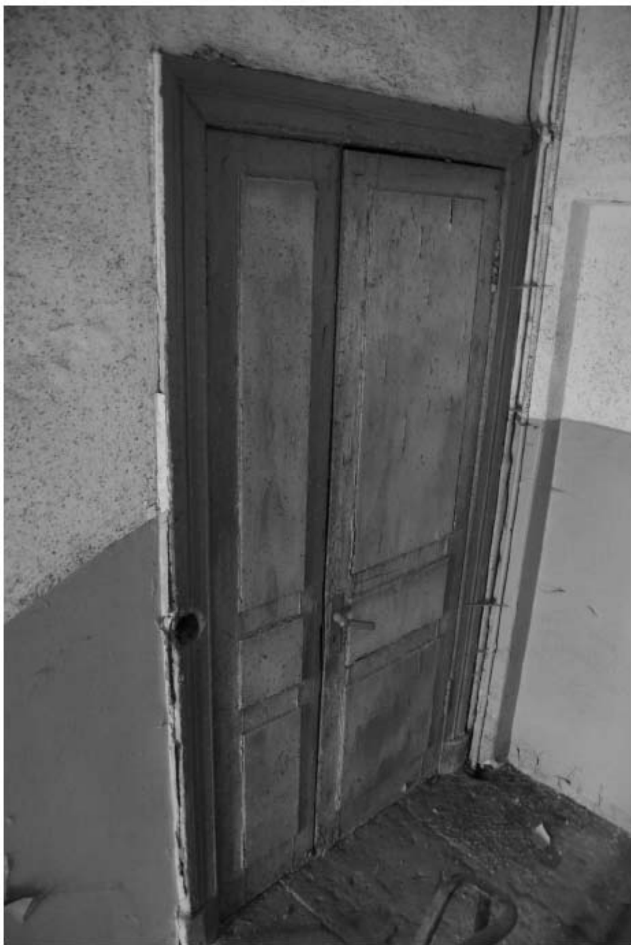
237. Лестница 4ЛК. Входная дверь лестничной площадки 4 этажа.
