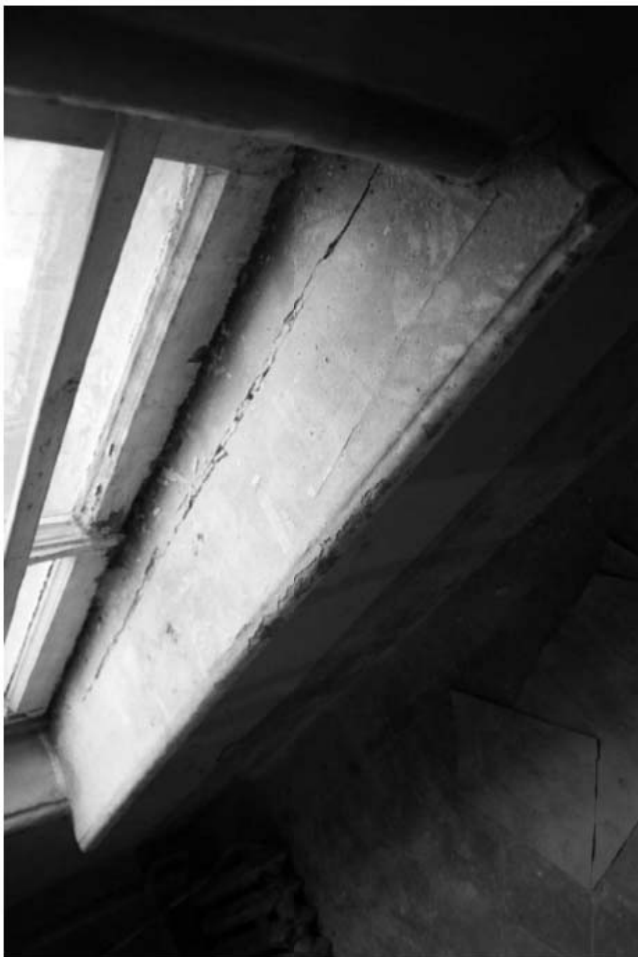
202. Лестница 3ЛК. Деревянный подоконник.
