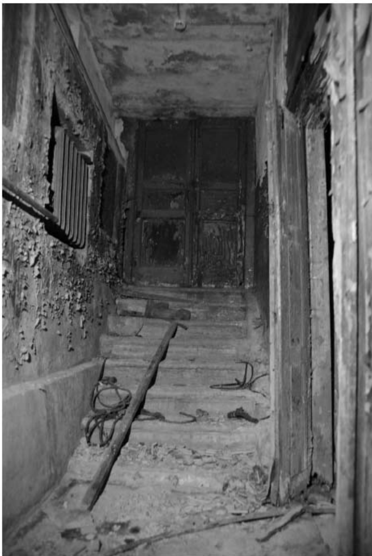
962. Подвал, помещение 6-Н. Вид на лестницу во двор.
