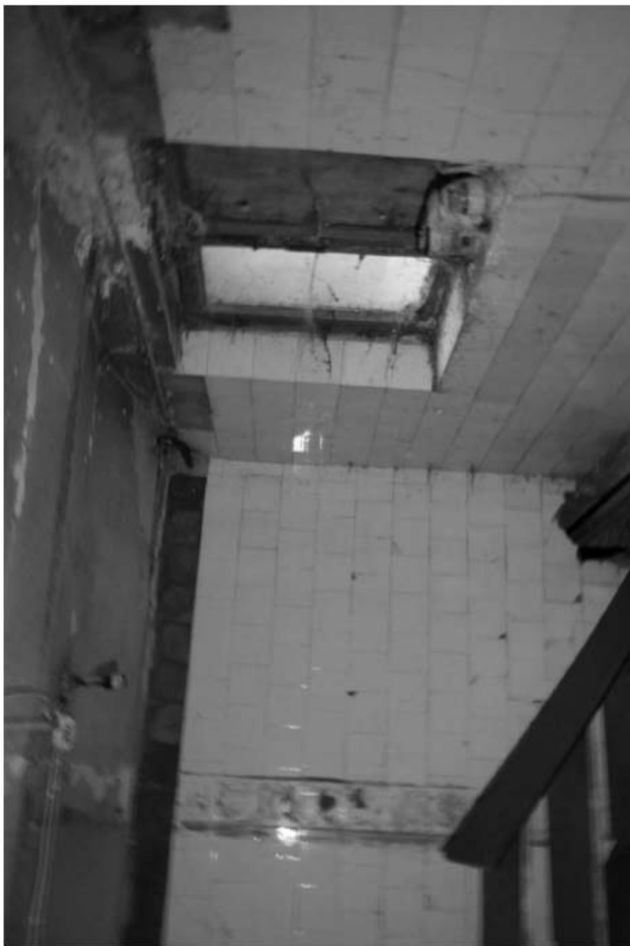
980. Подвал, помещение 6-Н. Интерьер комнаты 9,4 кв.м.
