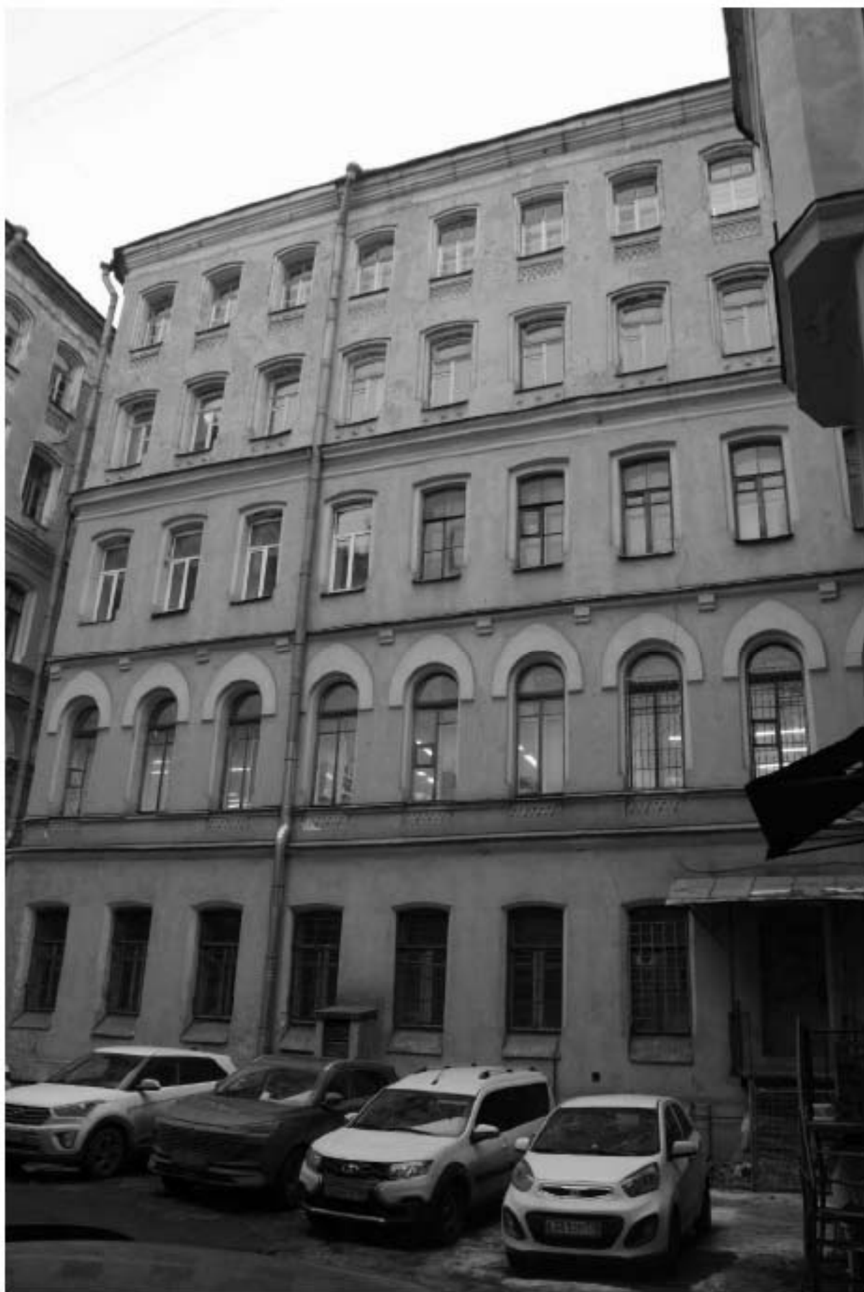
78. Вид дворового фасада.
