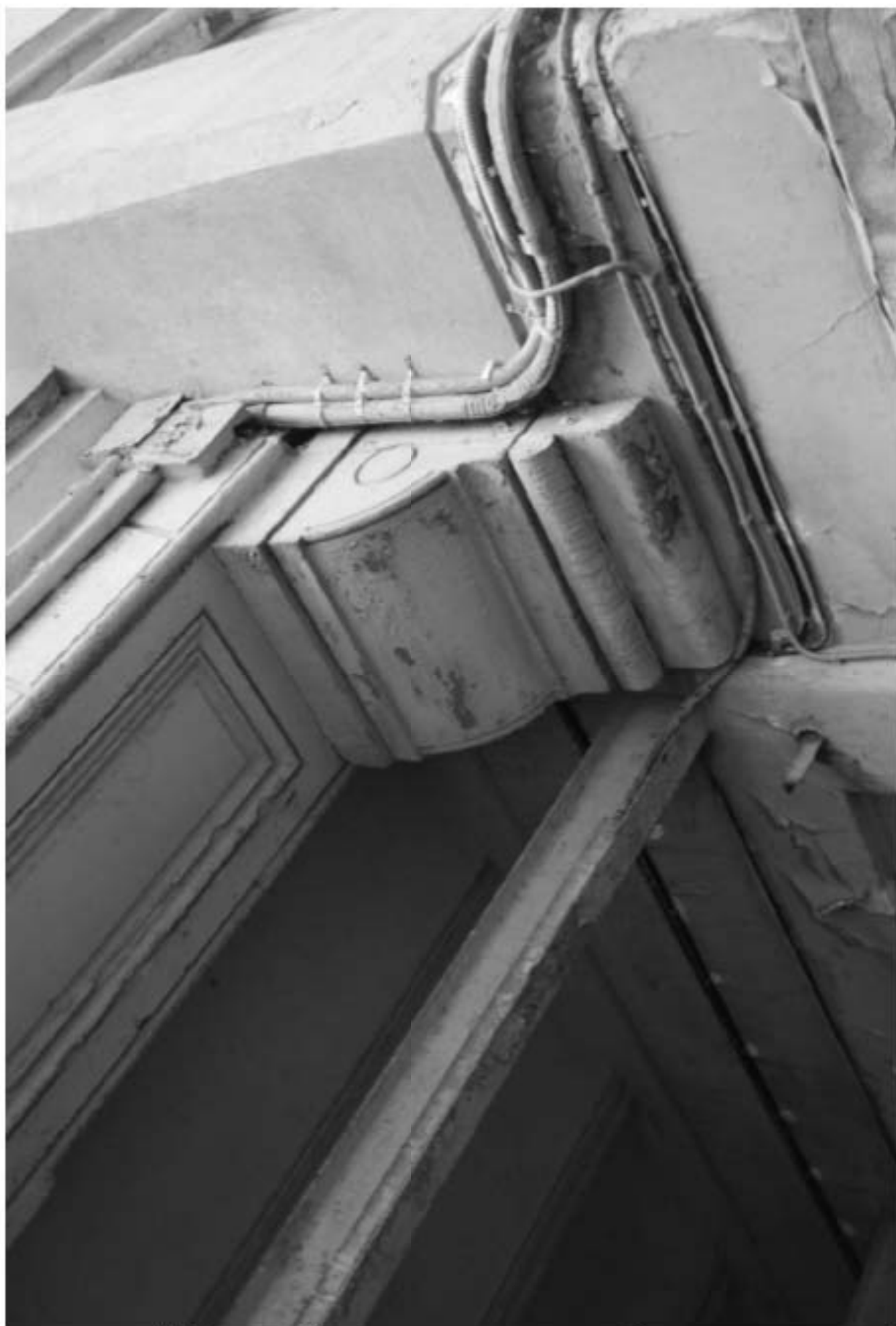
55. Воротный проезд лицевого корпуса. Фрагмент.
