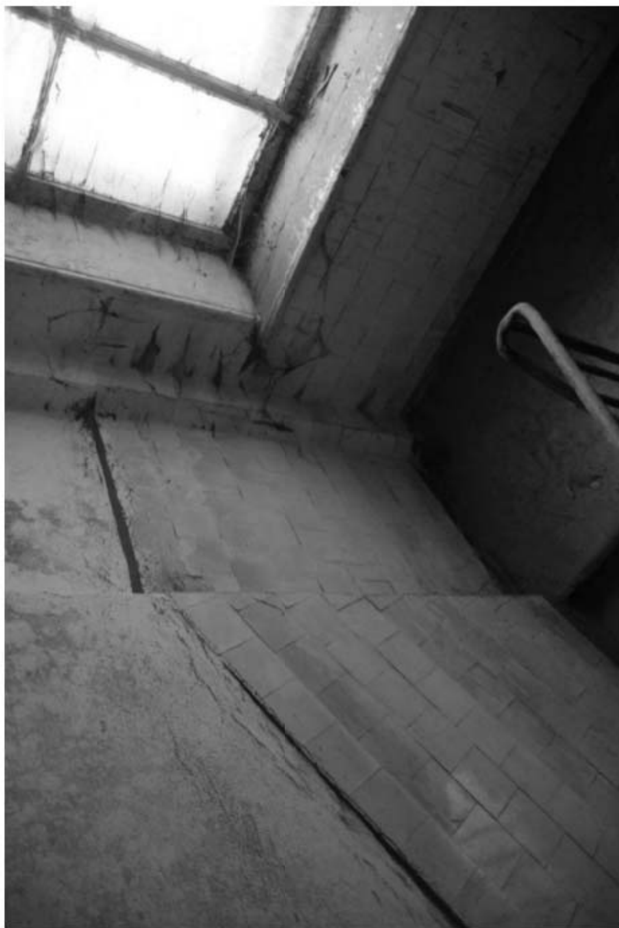
223. Лестница 4ЛК. Отделка стен.
