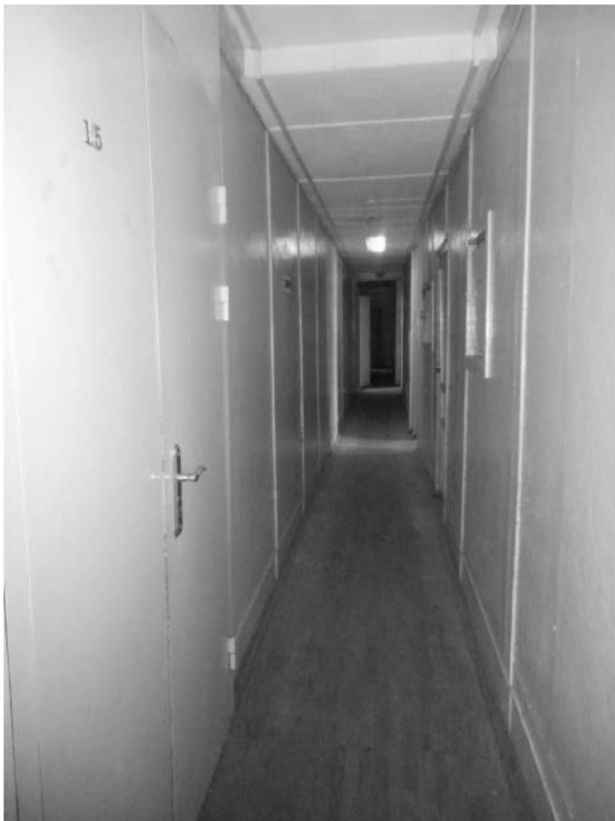
676. Этаж 3, помещение 17-Н. Вид коридора.
