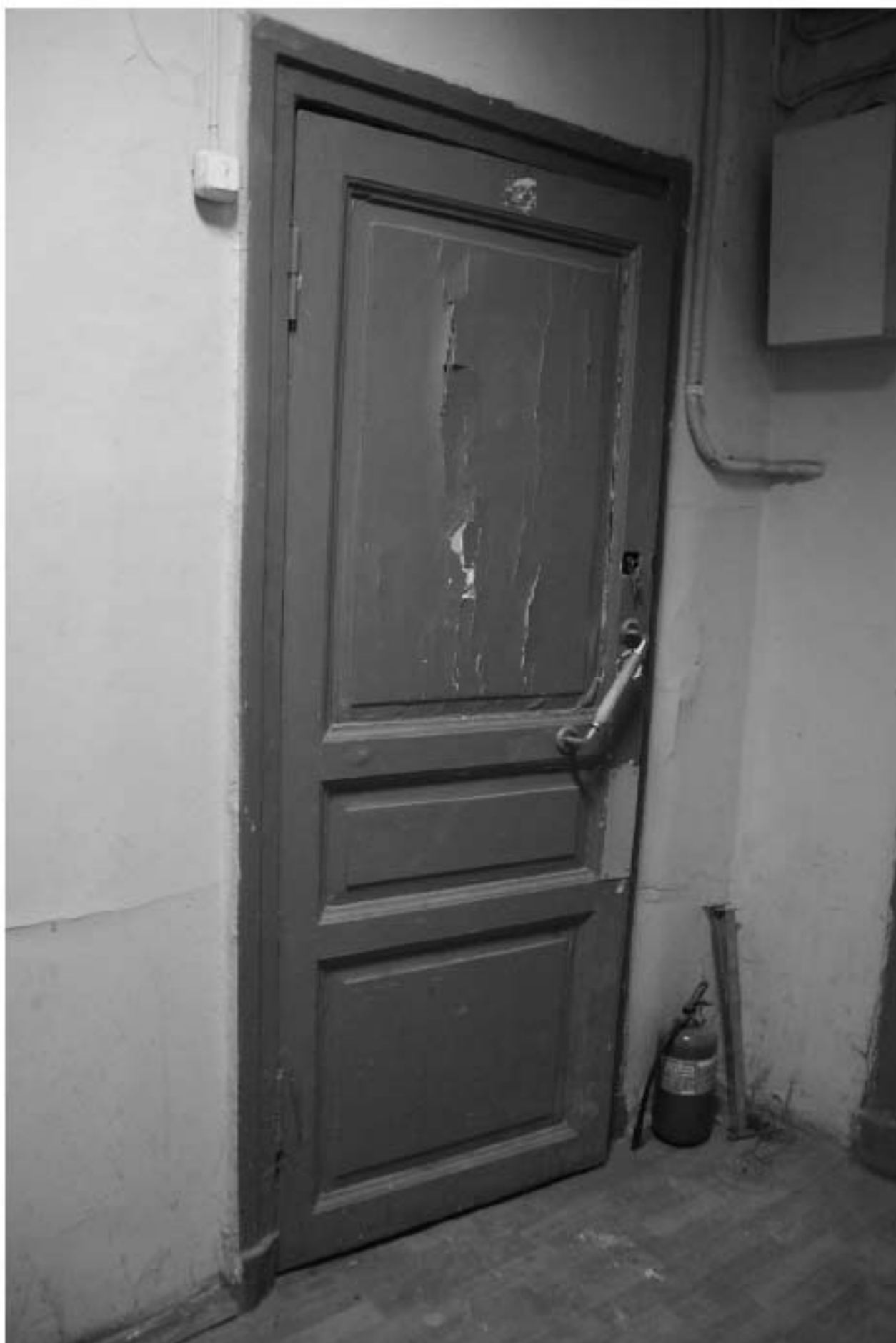
247. Этаж 1, помещение 20-Н. Входная дверь в комнату 3,6 кв.м.
