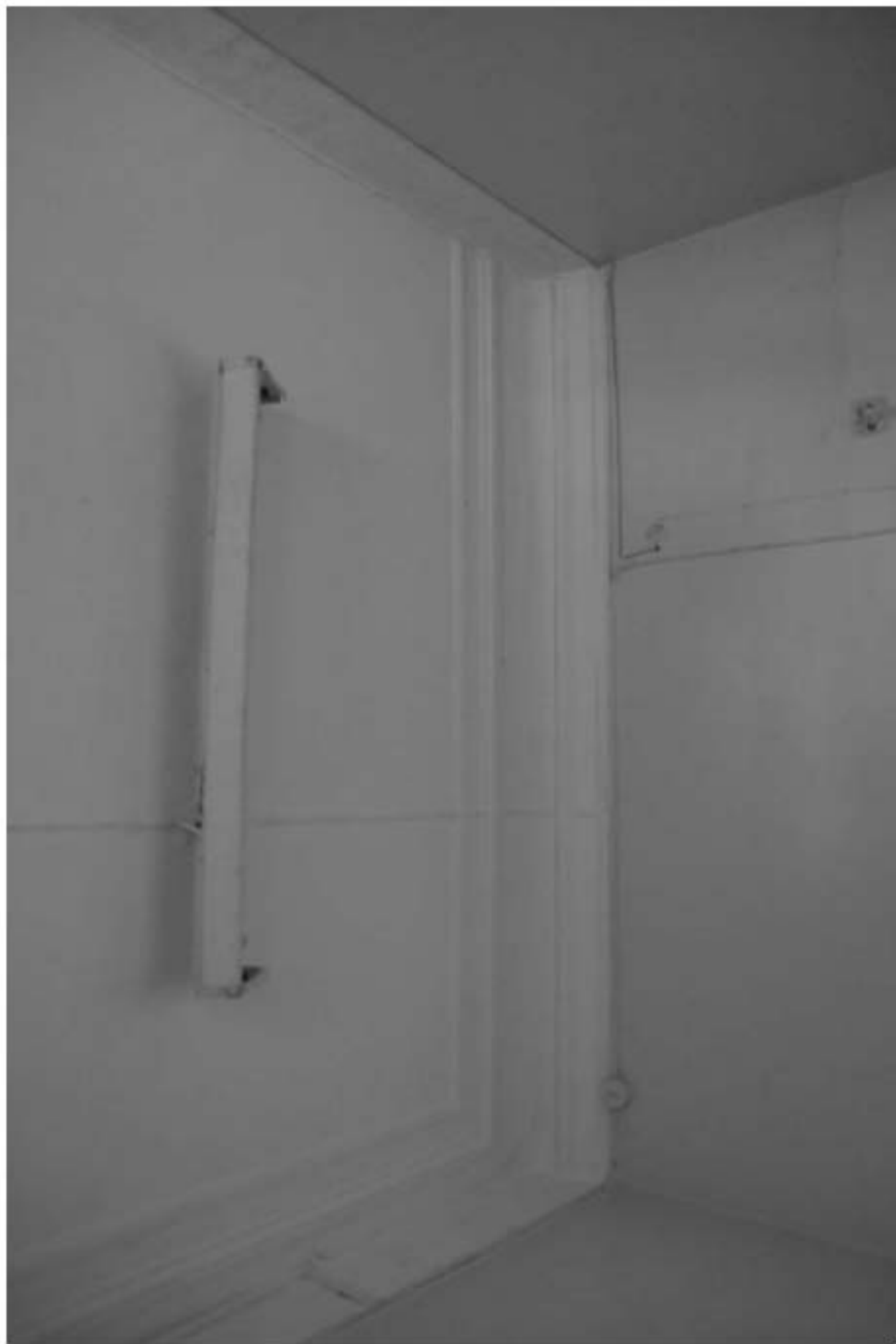
253. Этаж 1, помещение 20-Н. Потолок комнаты 10,3 кв.м.
