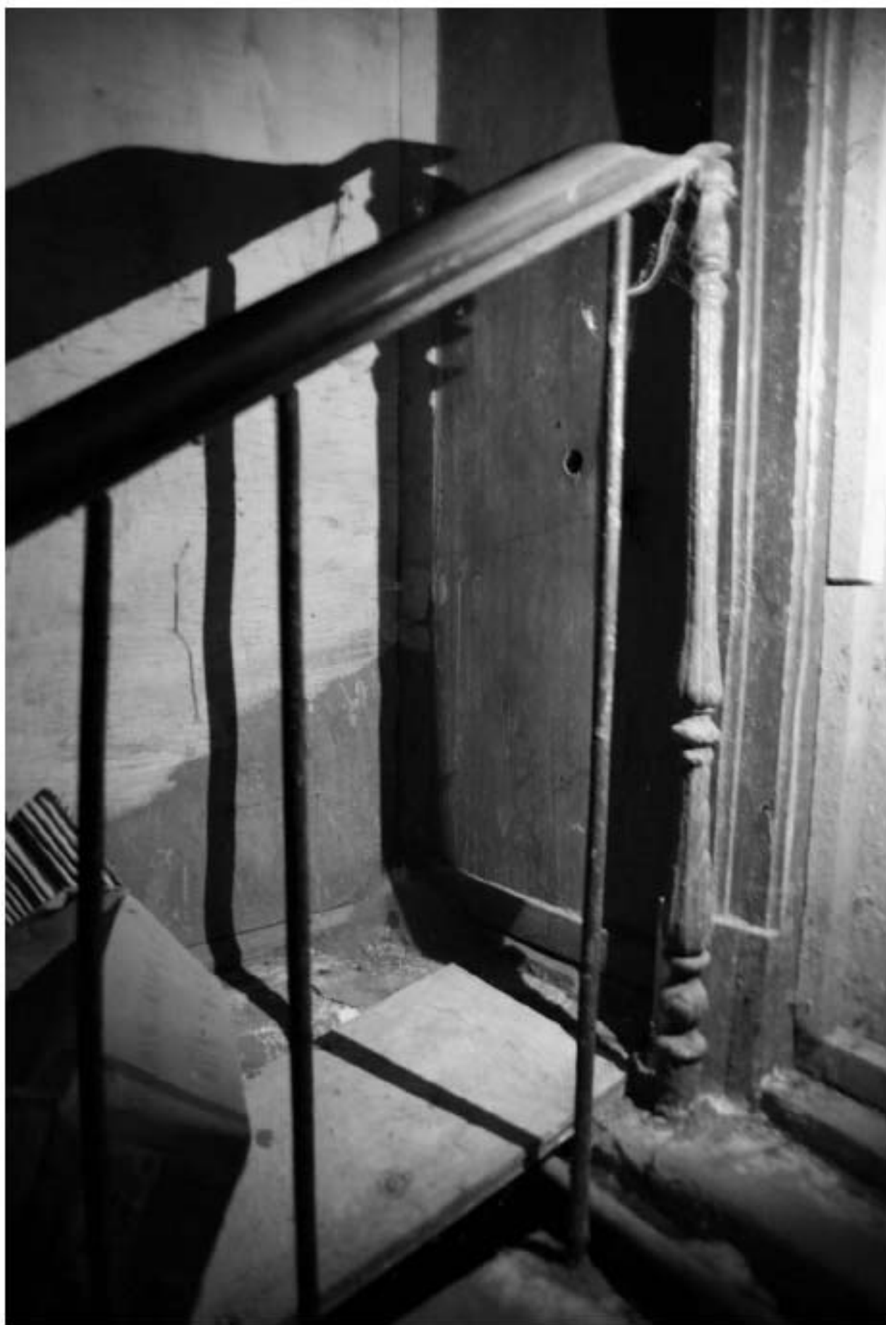
956. Подвал, помещение 6-Н. Ограждение лестницы на 1 этаж.
