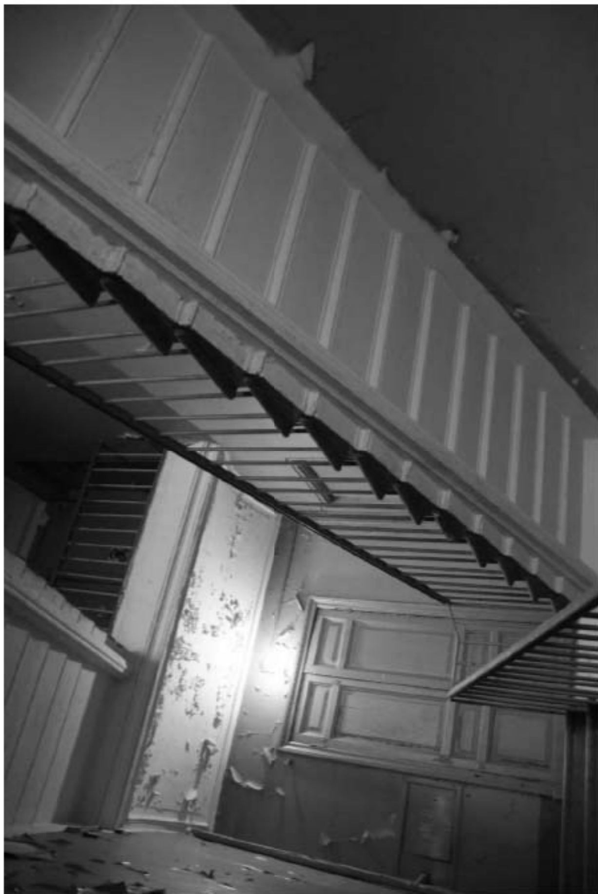
206. Лестница ЗЛК. Фрагмент.
