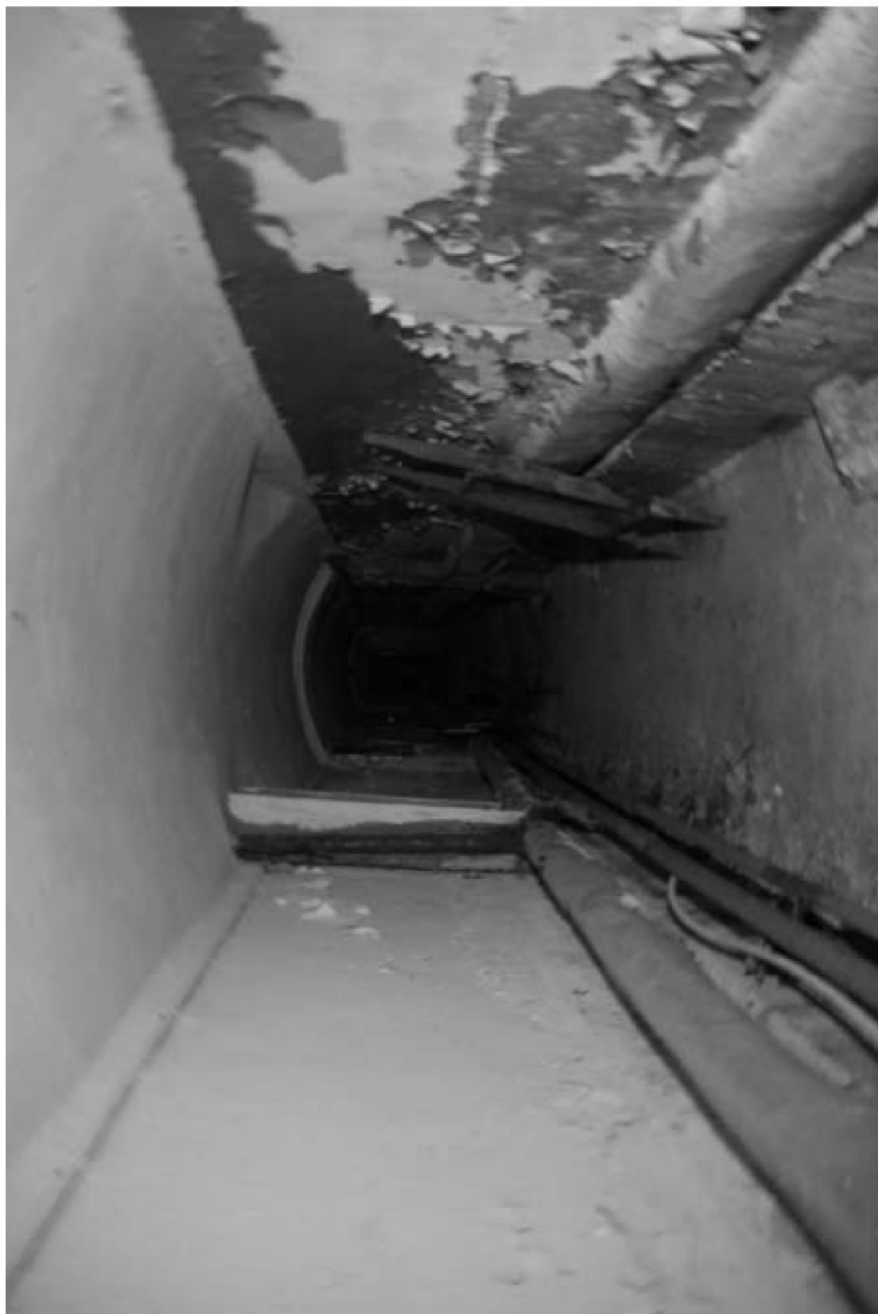
951. Подвал. Интерьер помещения 29-Н.
