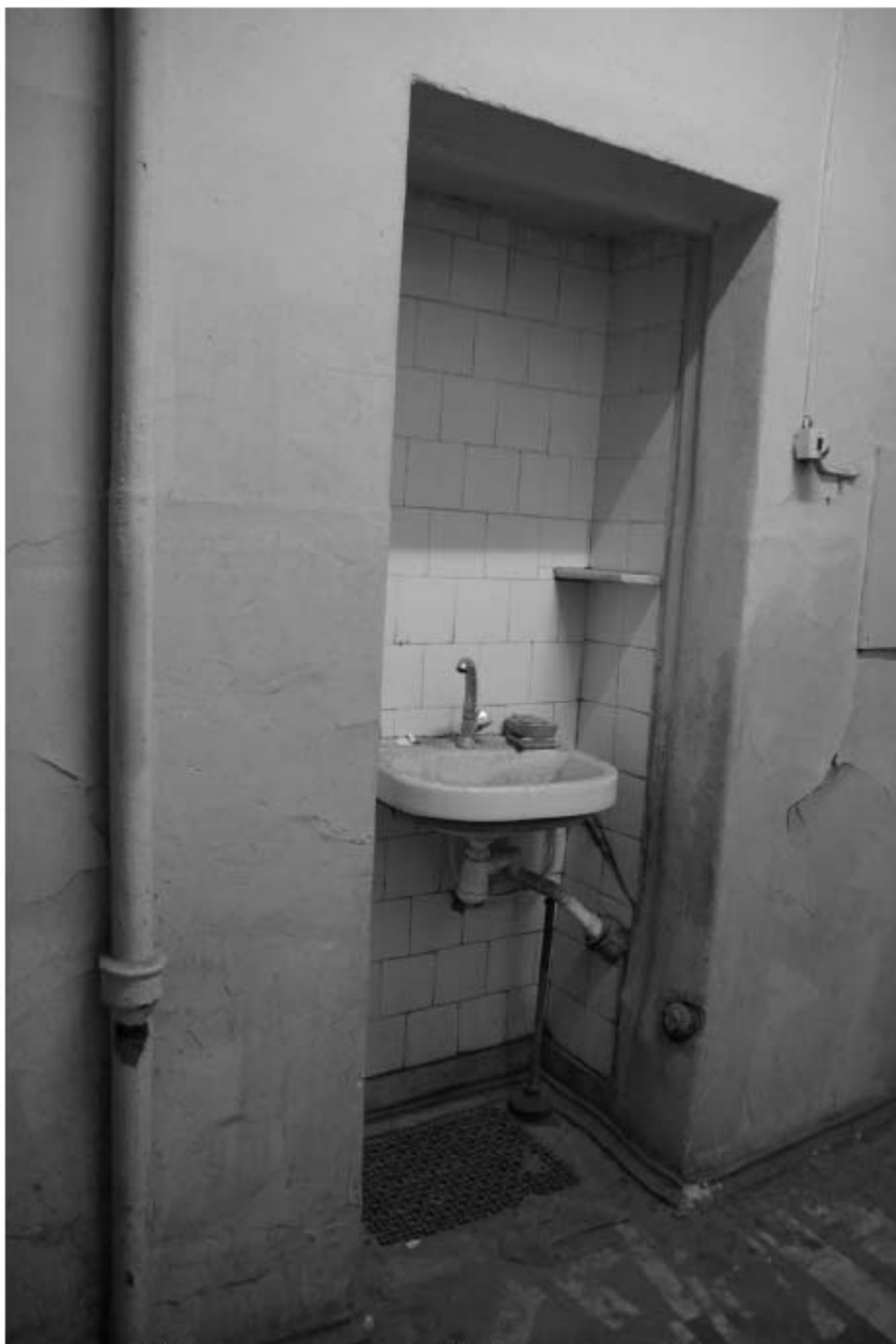
342. Этаж 1, помещение 15-Н. Вид коридора 25,7 кв.м.
