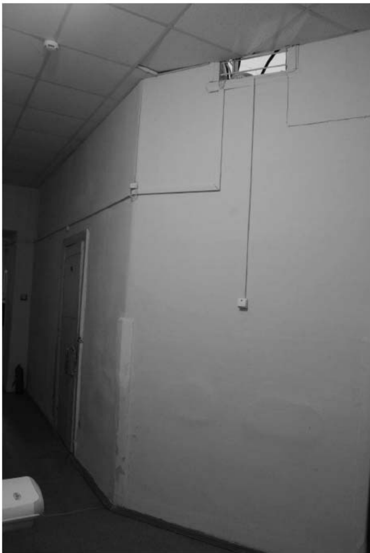
536. Этаж 2, помещение 16-Н. Вид коридора.
