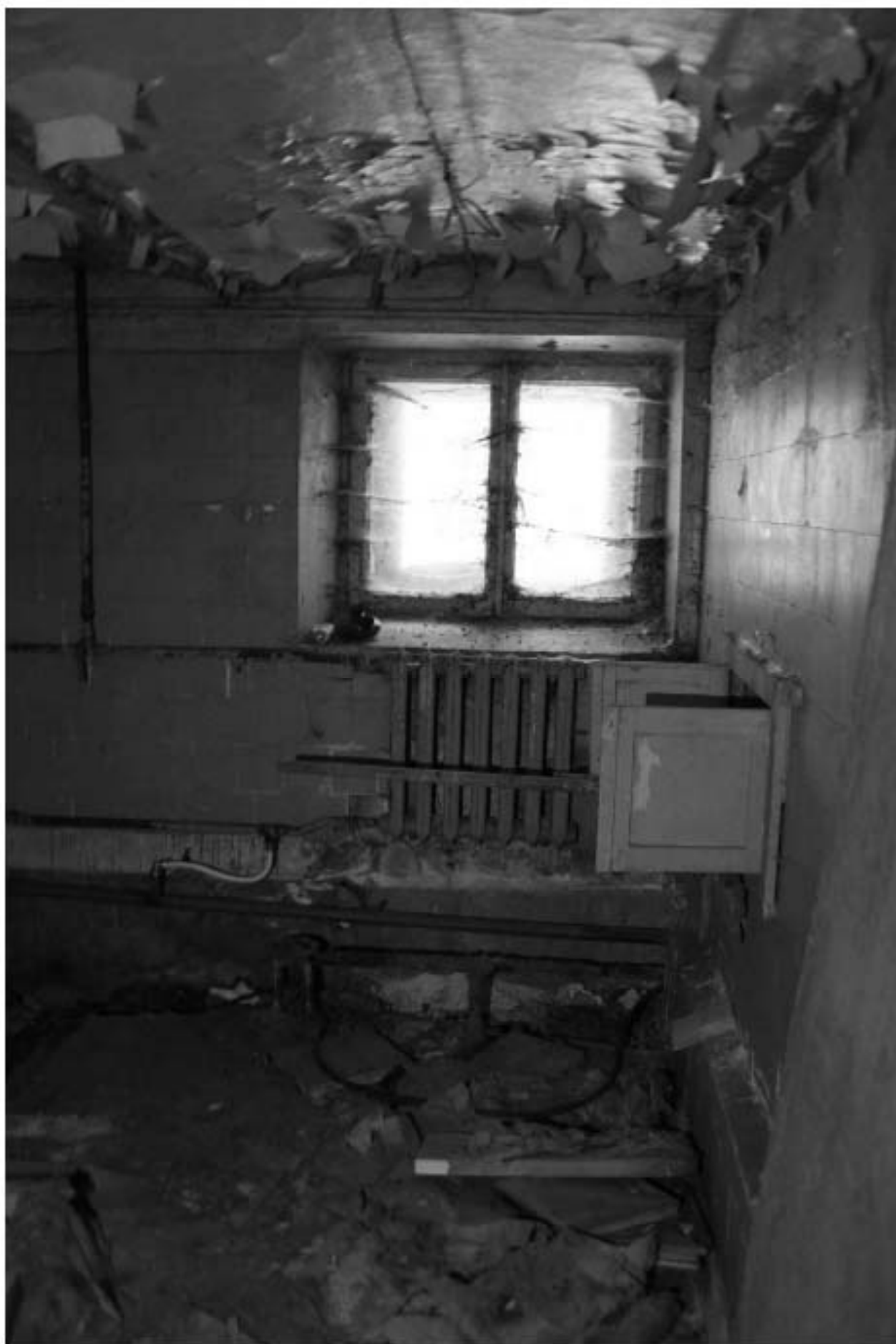
971. Подвал, помещение 6-Н. Вид коридора.
