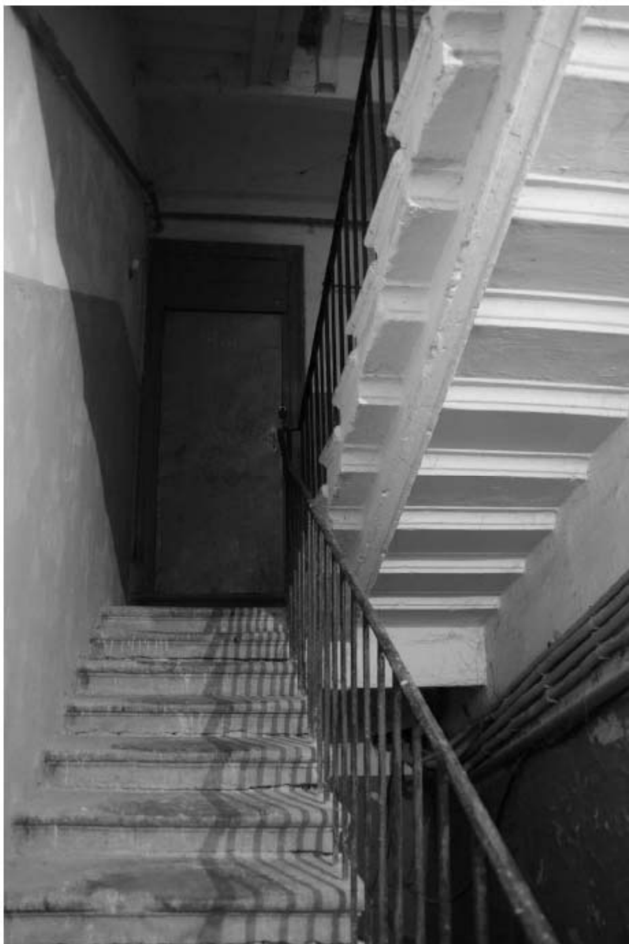
163. Лестница 2ЛК. Вид на лестничную площадку 1 этажа.
