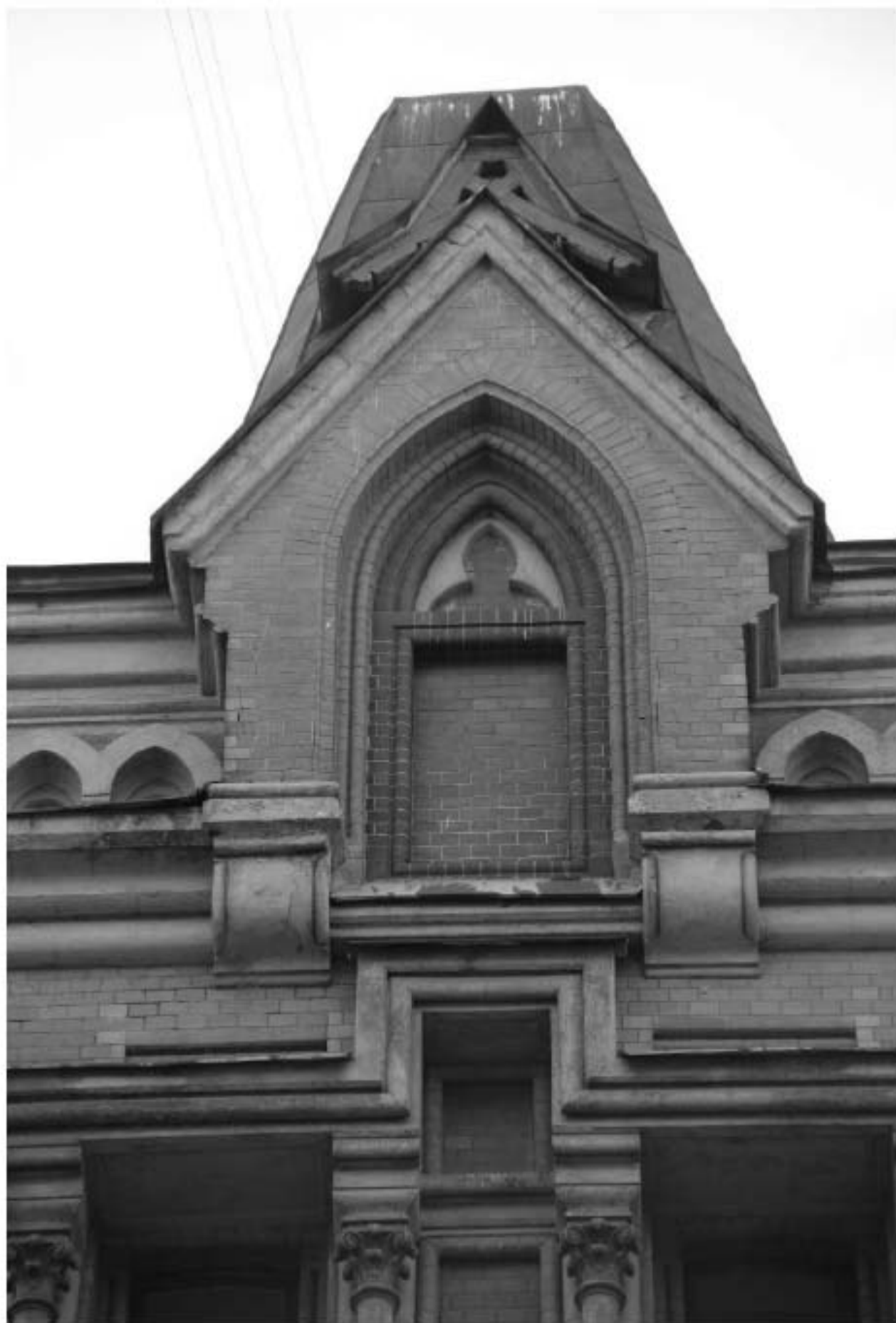
25. Фрагмент лицевого фасада.
