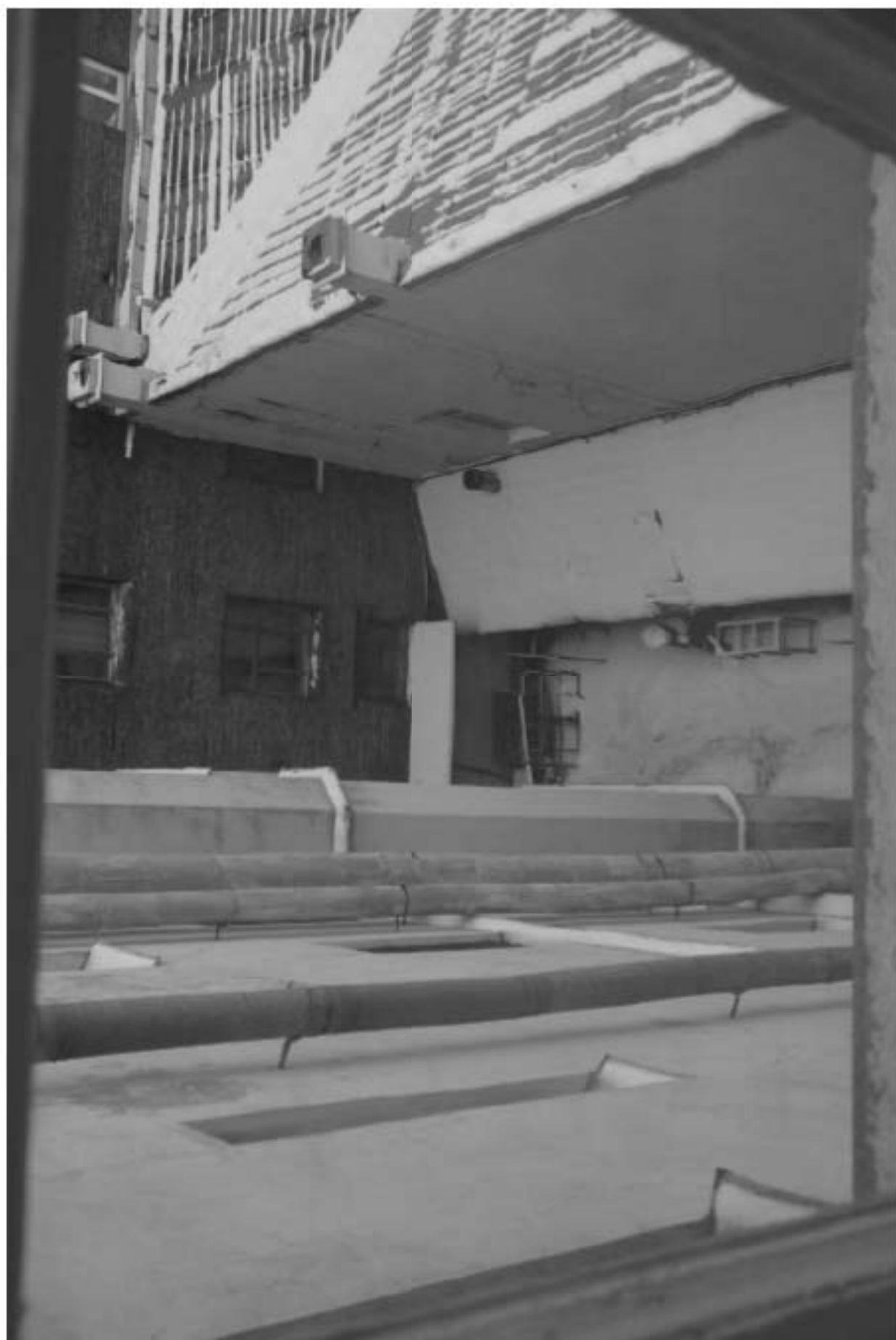
108. Вид второго двора.
