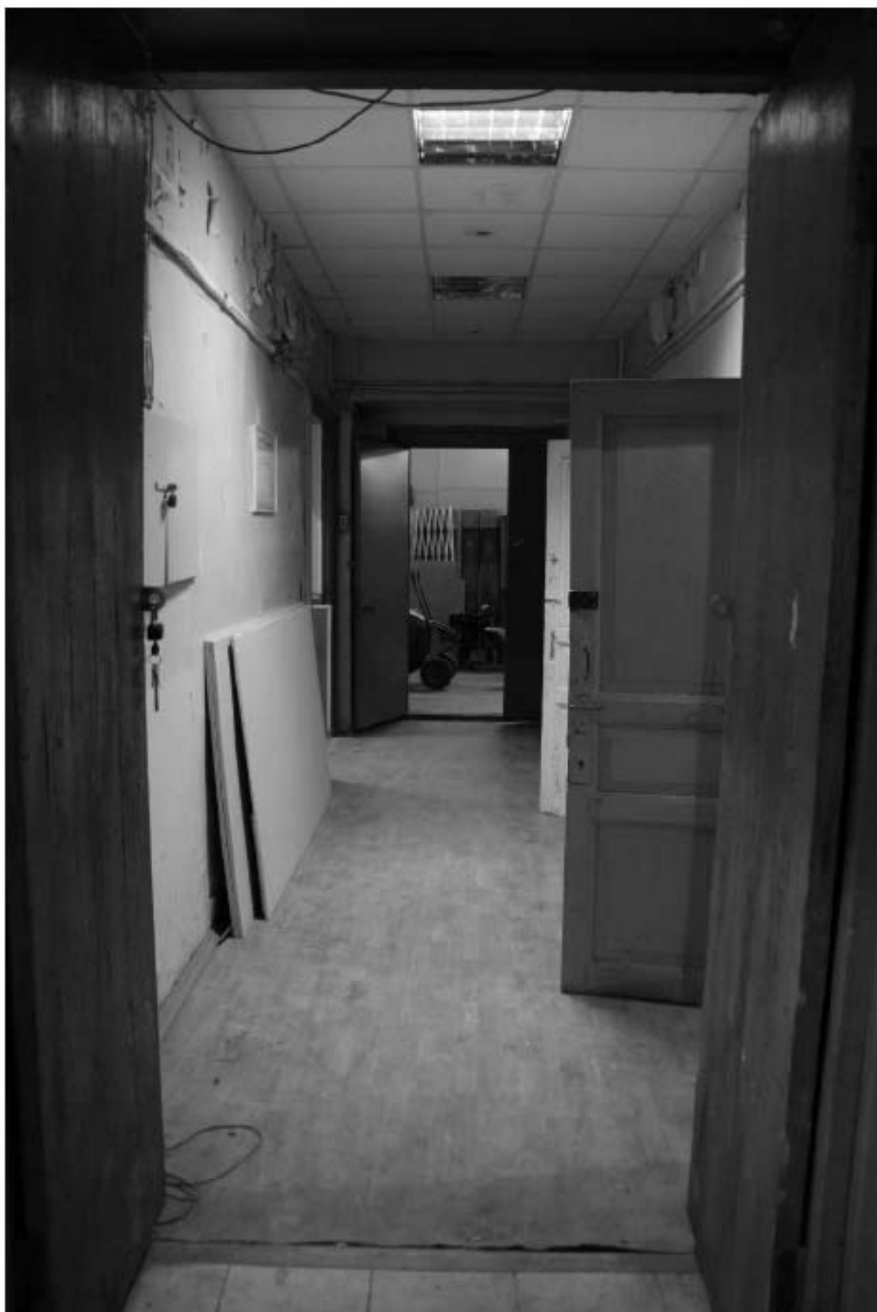
246. Этаж 1, помещение 20-Н. Вид коридора 12 кв.м.
