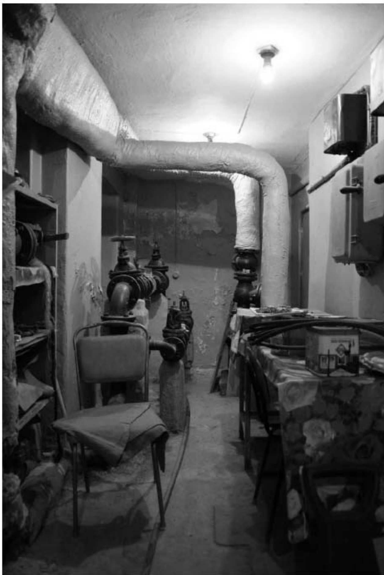
1008. Подвал, интерьер помещения 9-Н.
