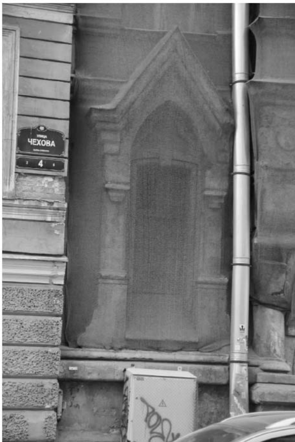
23. Фрагмент лицевого фасада
