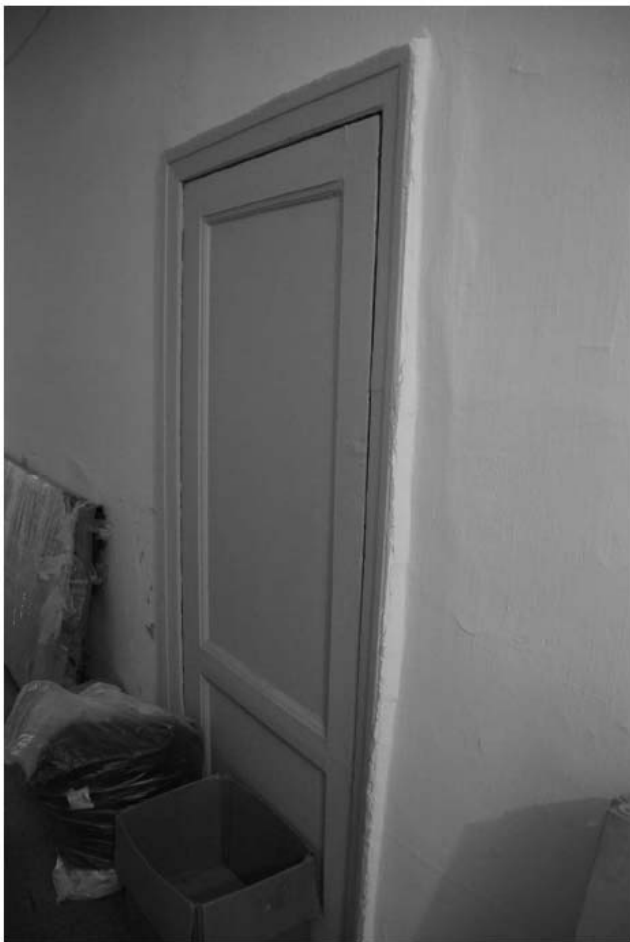
573. Этаж 2, помещение 16-Н. Вид коридора.
