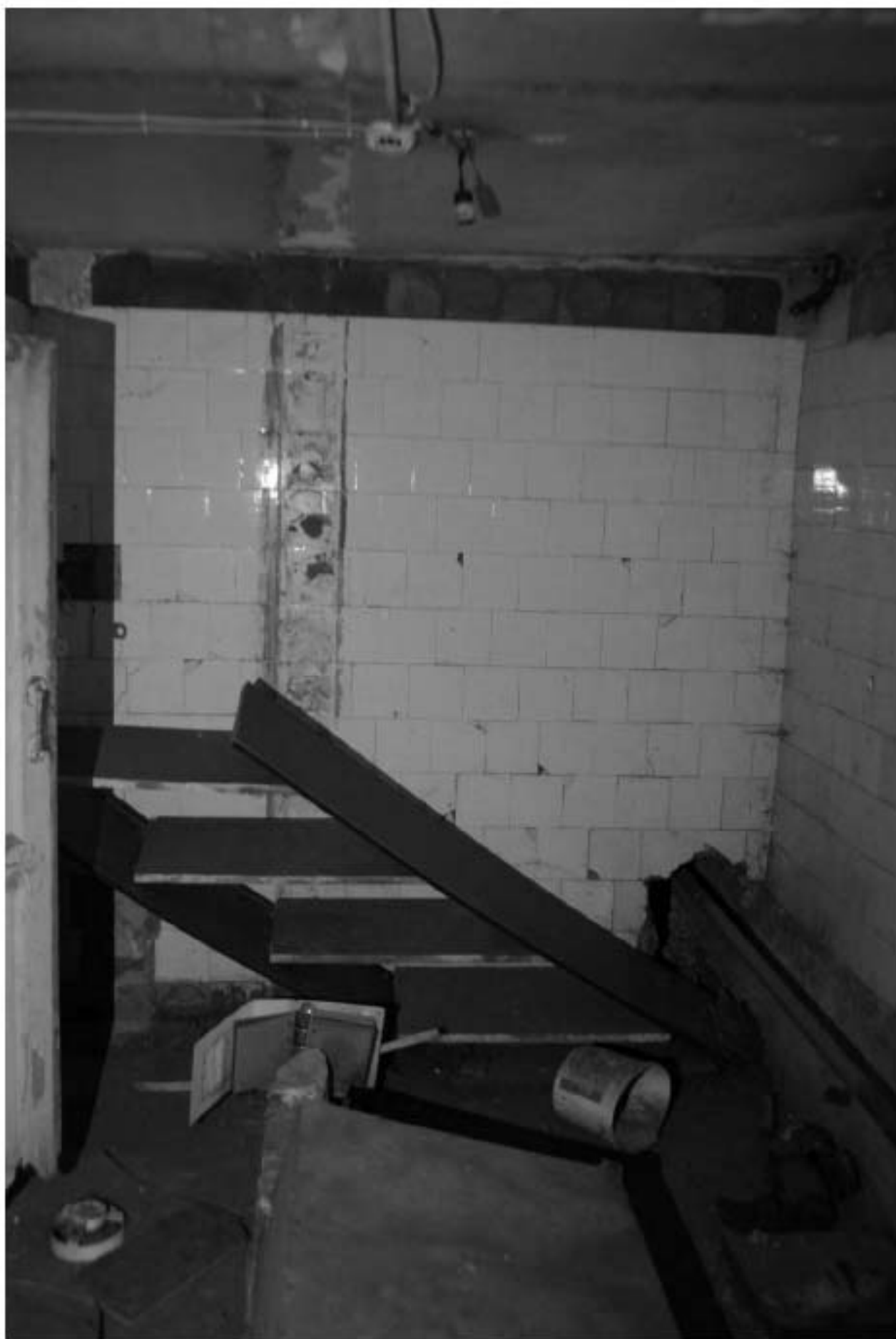
981. Подвал, помещение 6-Н. Интерьер комнаты 9,4 кв.м.
