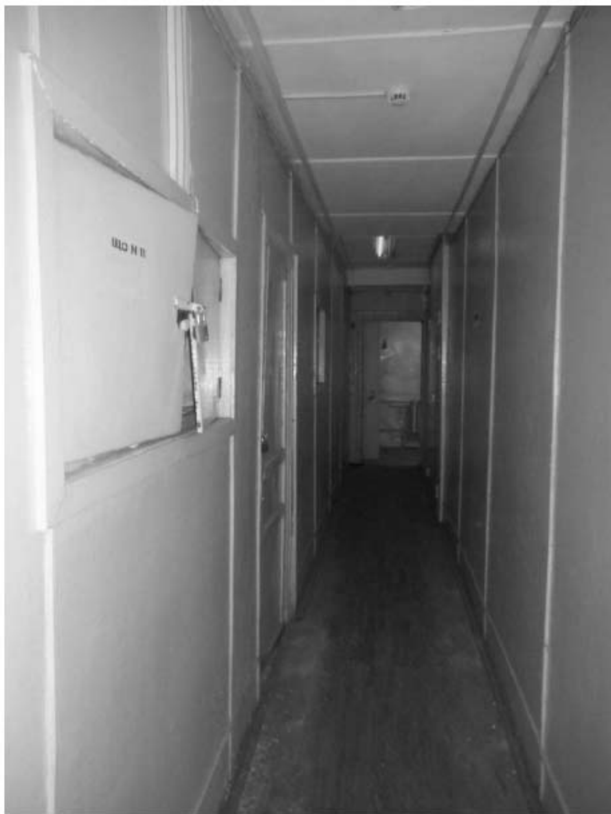
685. Этаж 3, помещение 17-Н. Вид коридора.
