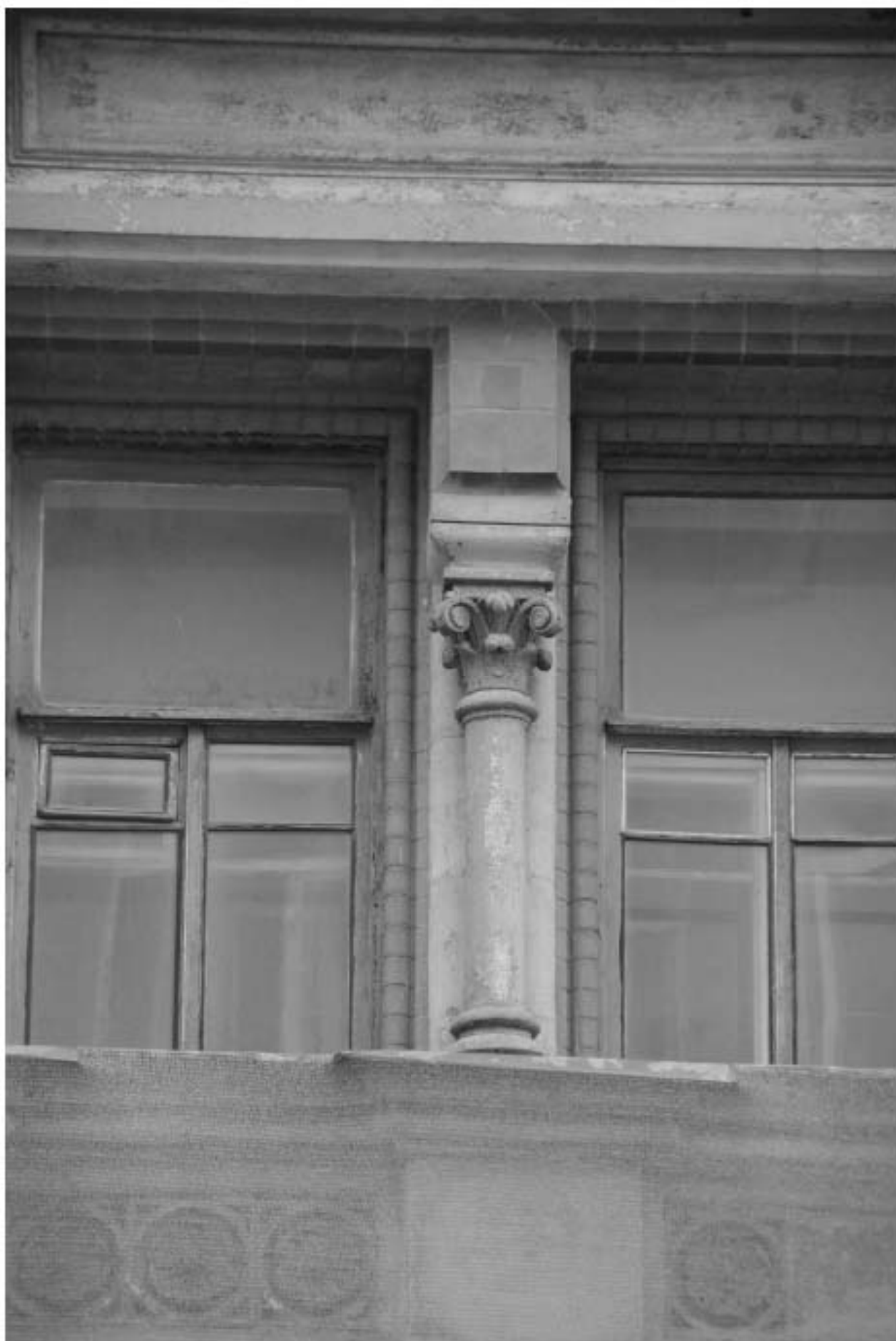
12. Фрагмент лицевого фасада.
