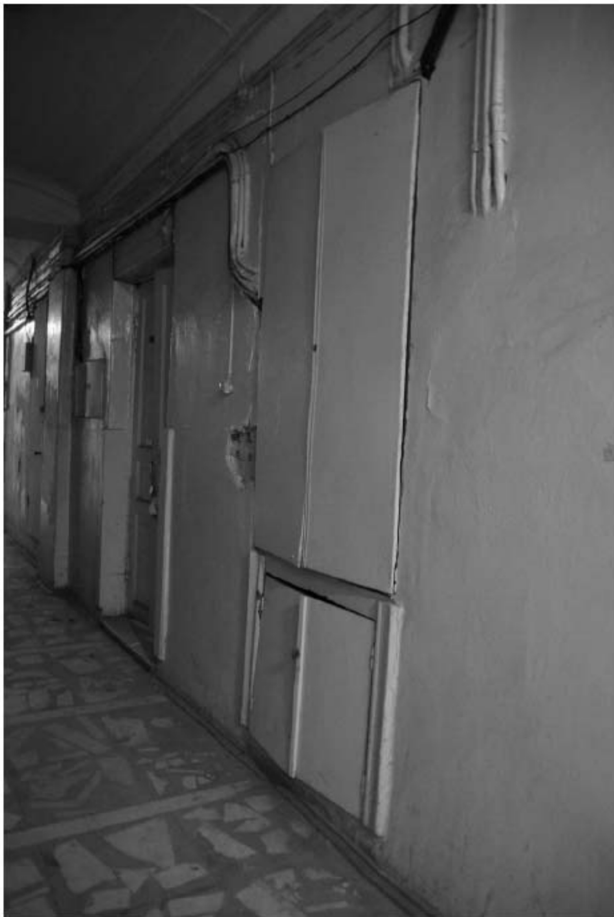
333. Этаж 1, помещение 15-Н. Вид коридора.
