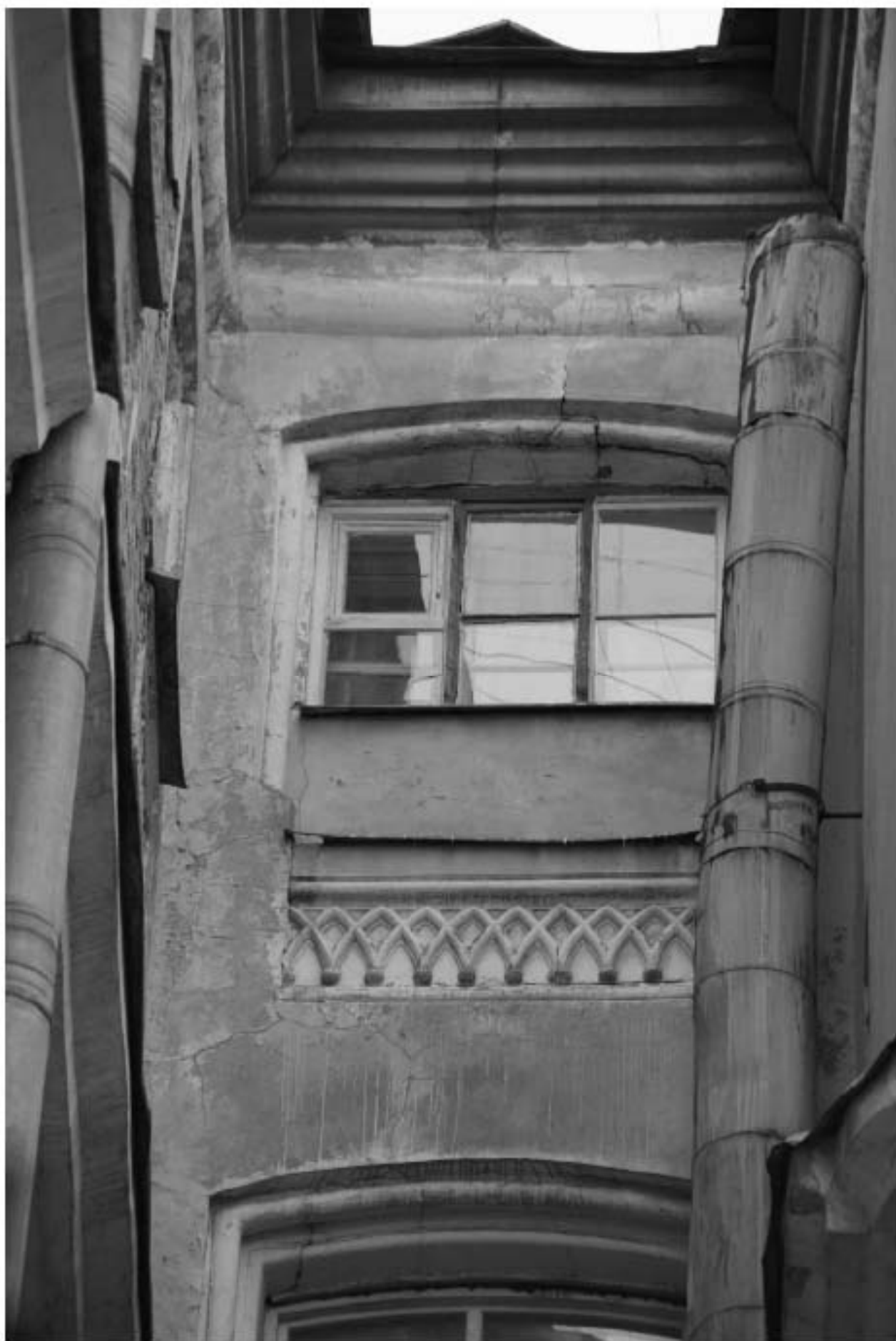
82. Фрагмент дворового фасада.
