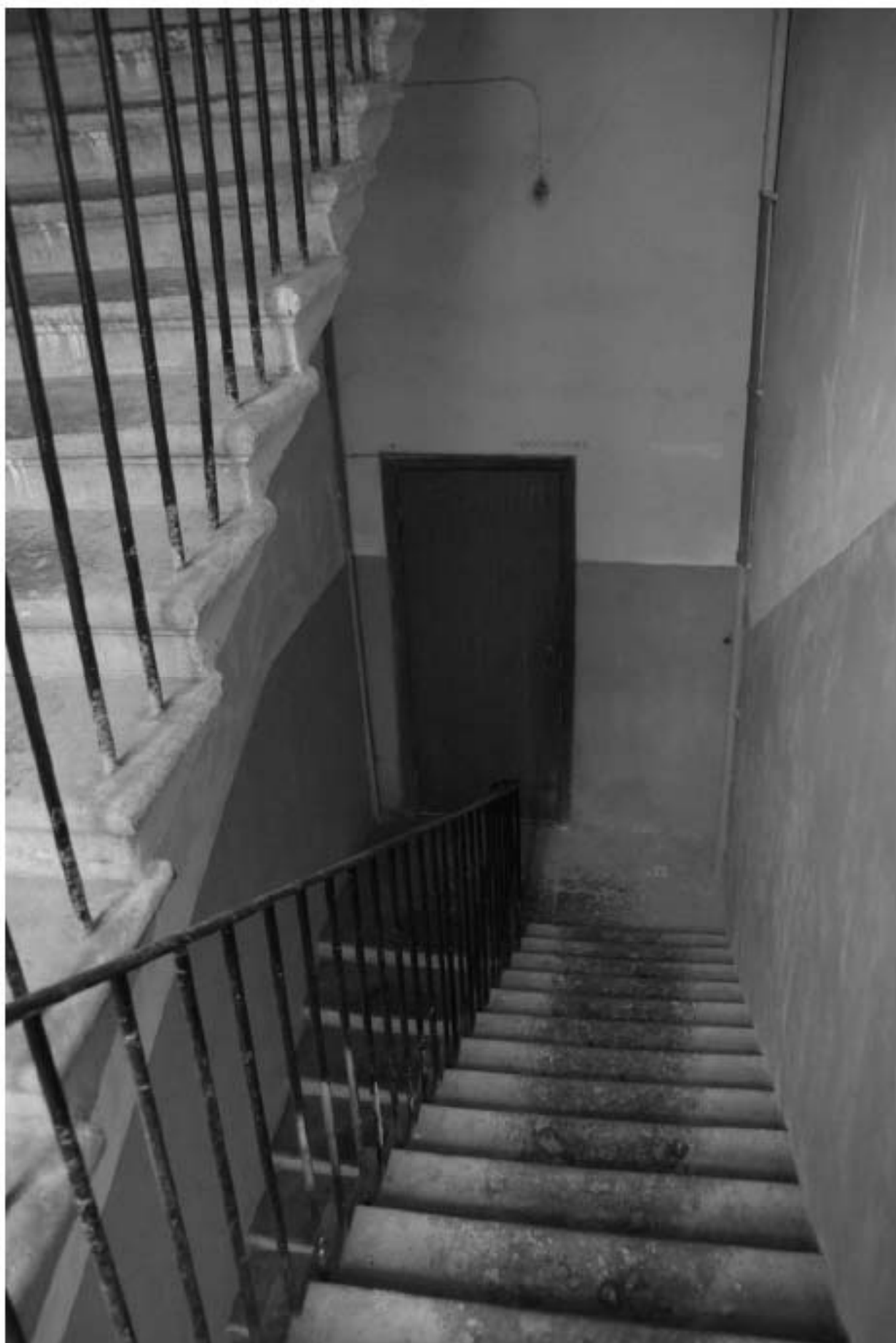
367. Лестница 2ЛК. Вид на лестничную площадку 2 этажа.
