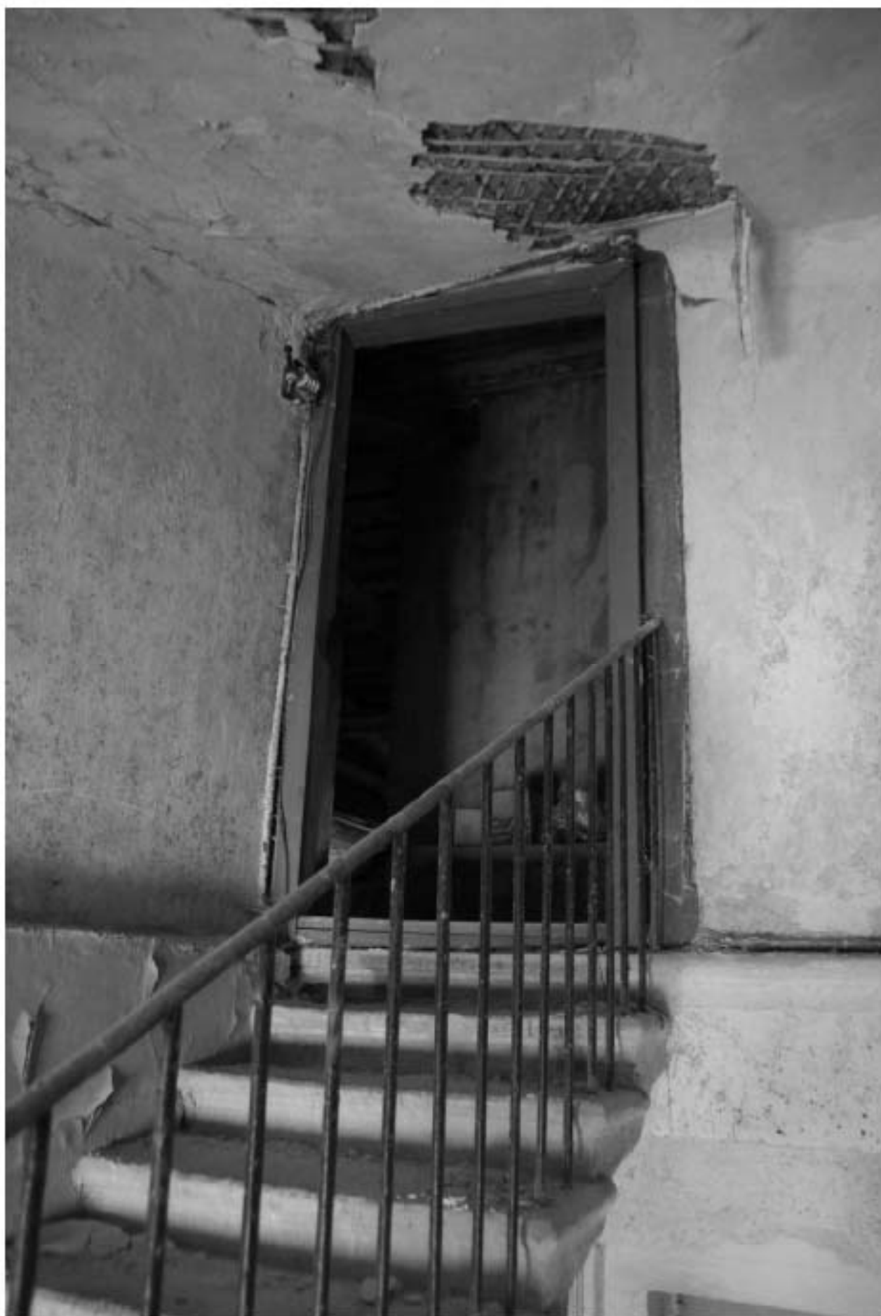
245. Лестница 4ЛК. Выход на чердак.
