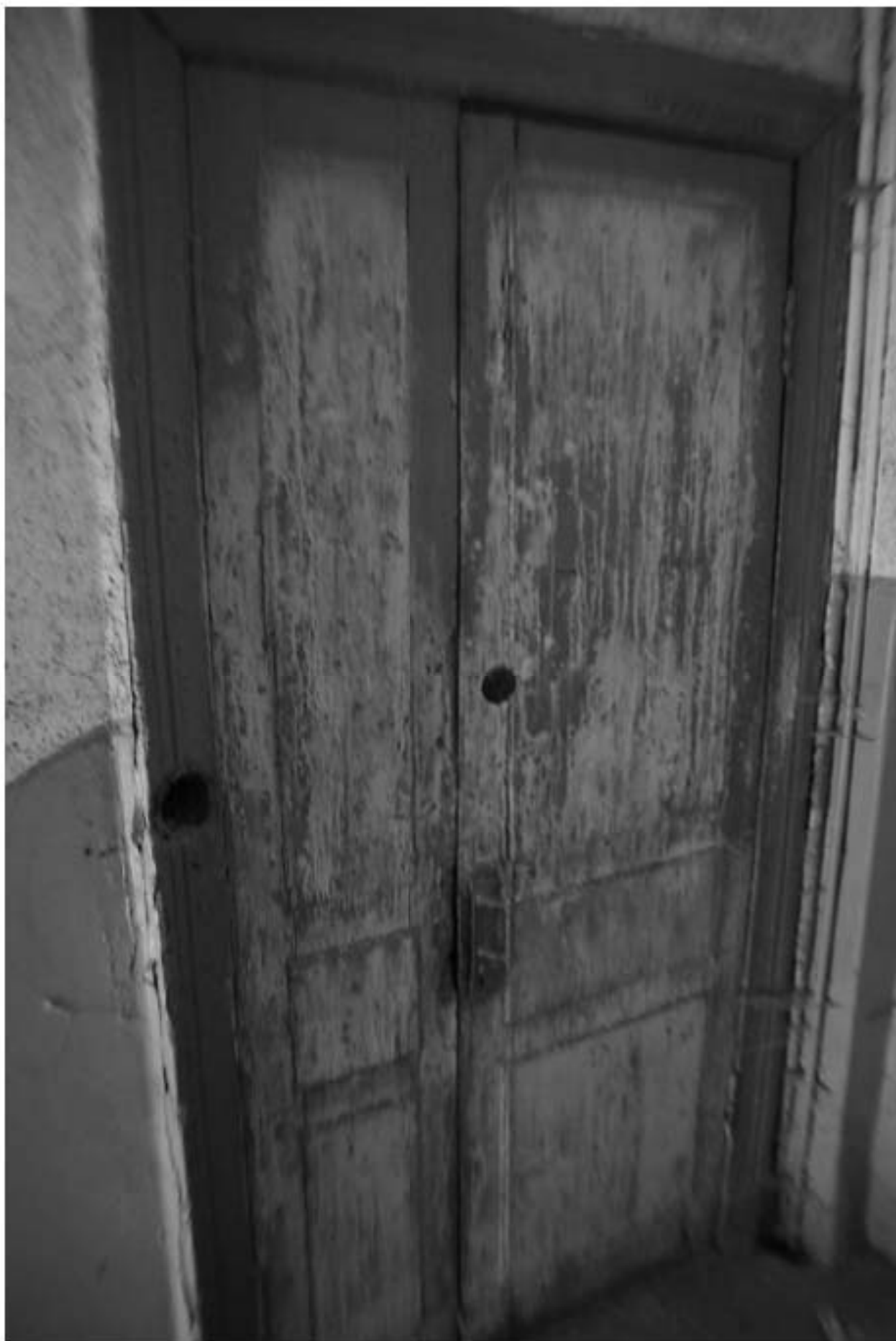
231. Лестница 4ЛК. Дверь лестничной площадки 3 этажа.
