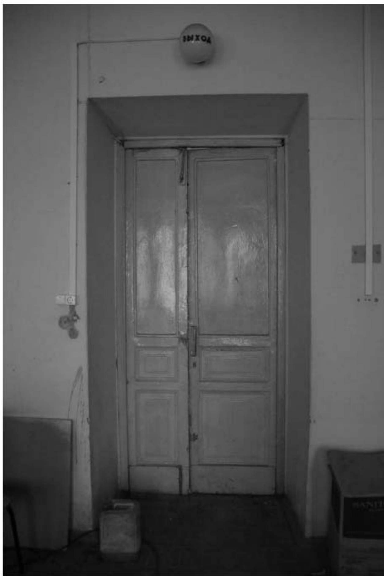
341. Этаж 1, помещение 15-Н. Входная дверь комнаты 52,1 кв.м.
