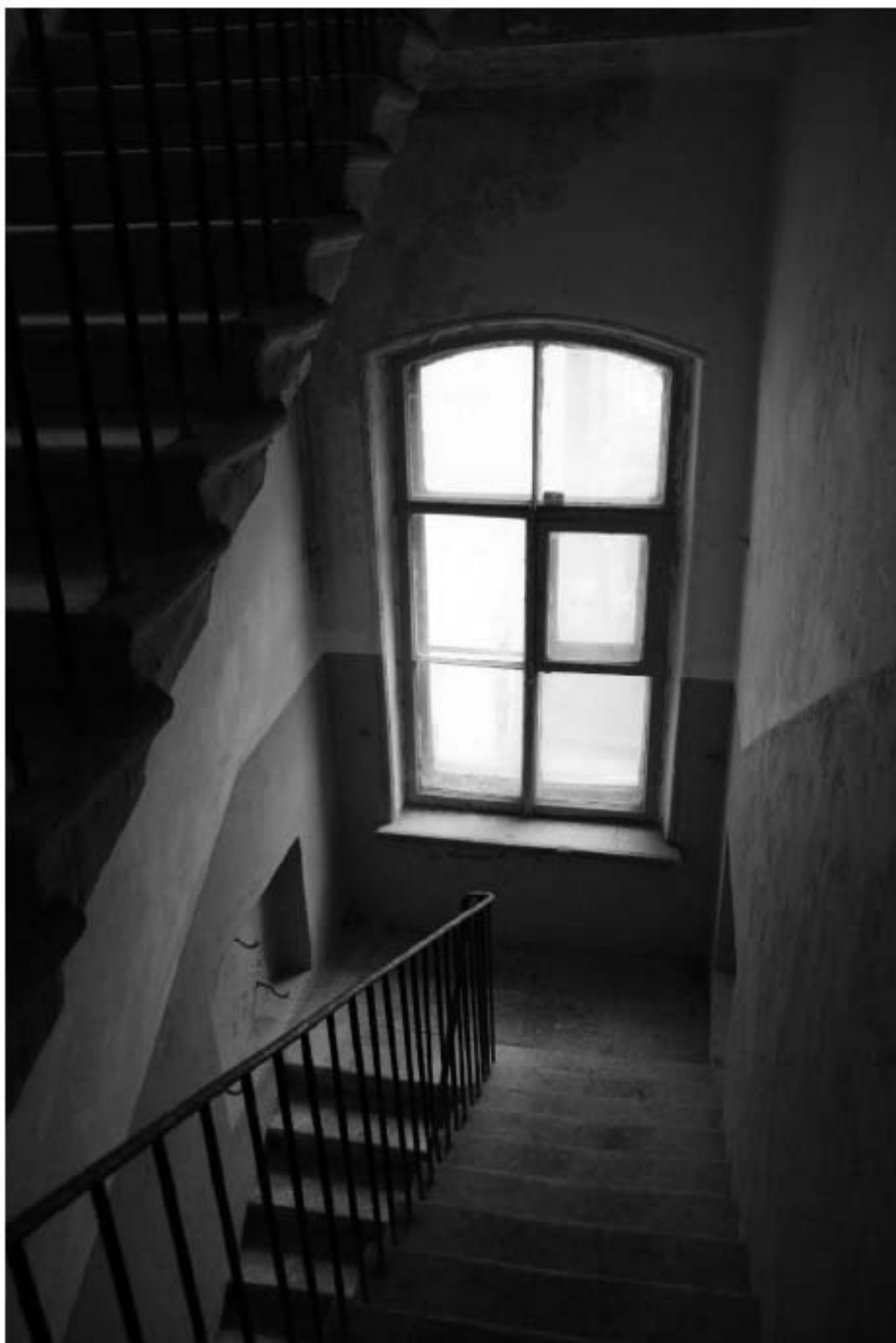
569. Лестница 2ЛК. Лестничная площадка между 2 и 3 этажами.
