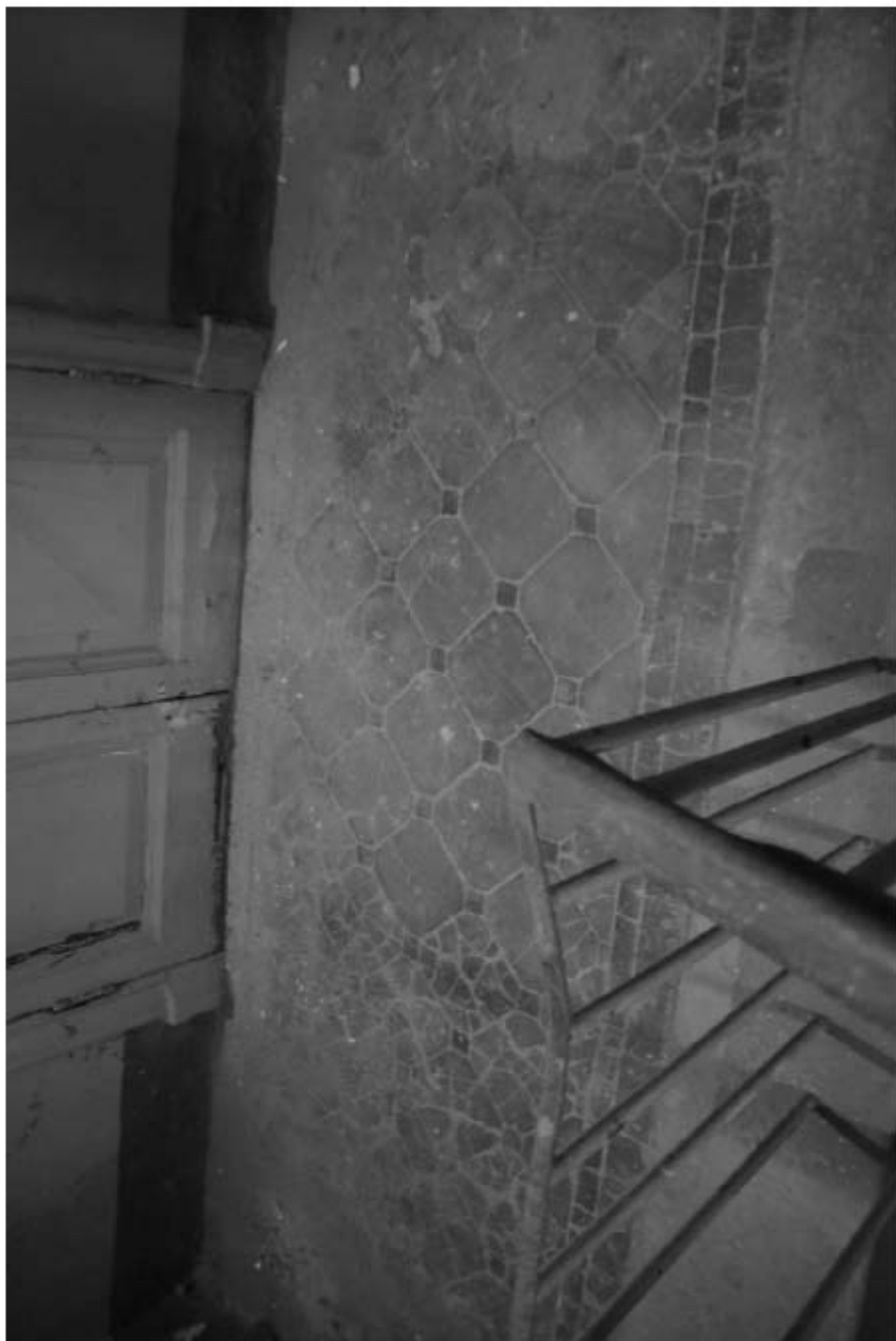
208. Лестница 3ЛК. Покрытие лестничной площадки 4 этажа.
