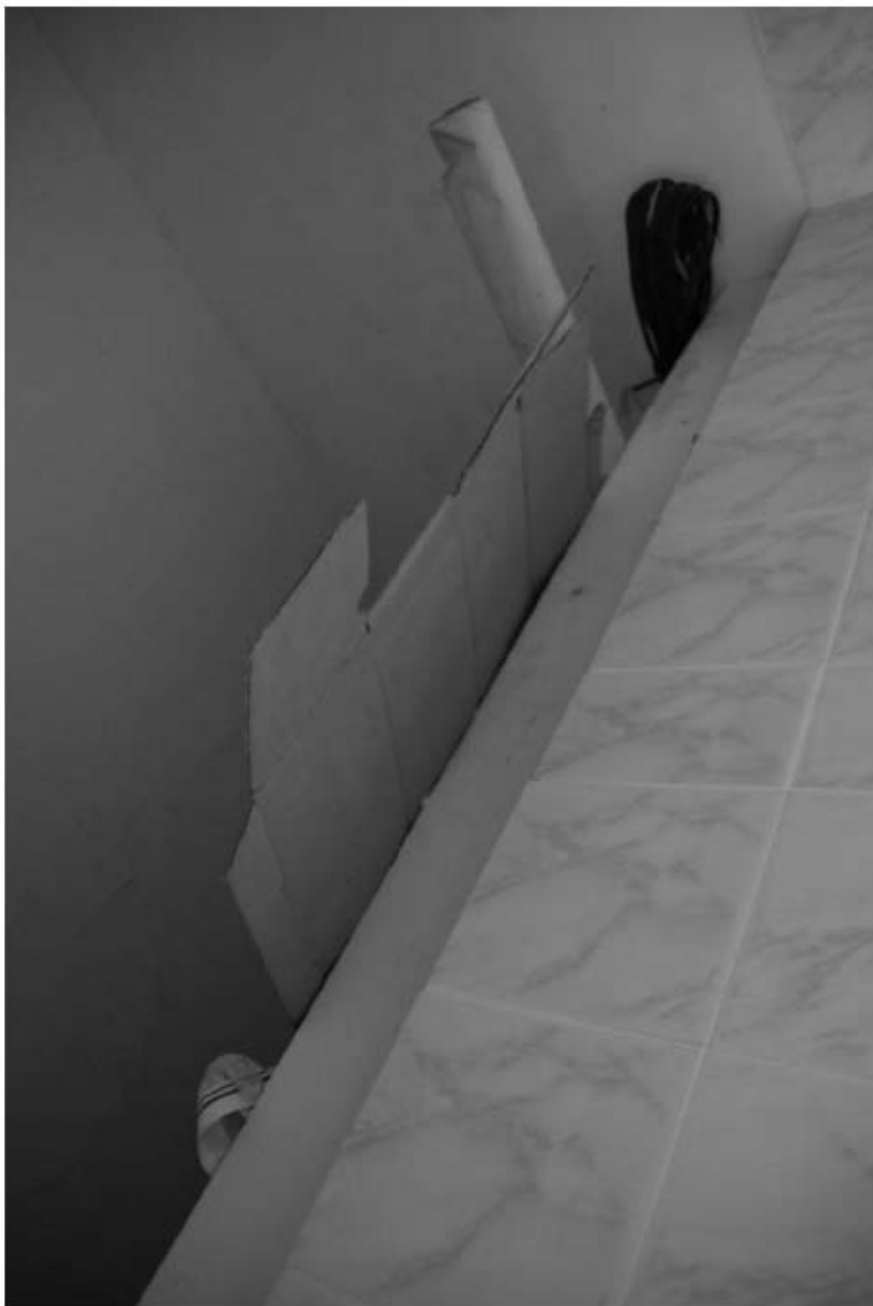
388. Этаж 1, помещение 15-Н. Интерьер душевой.
