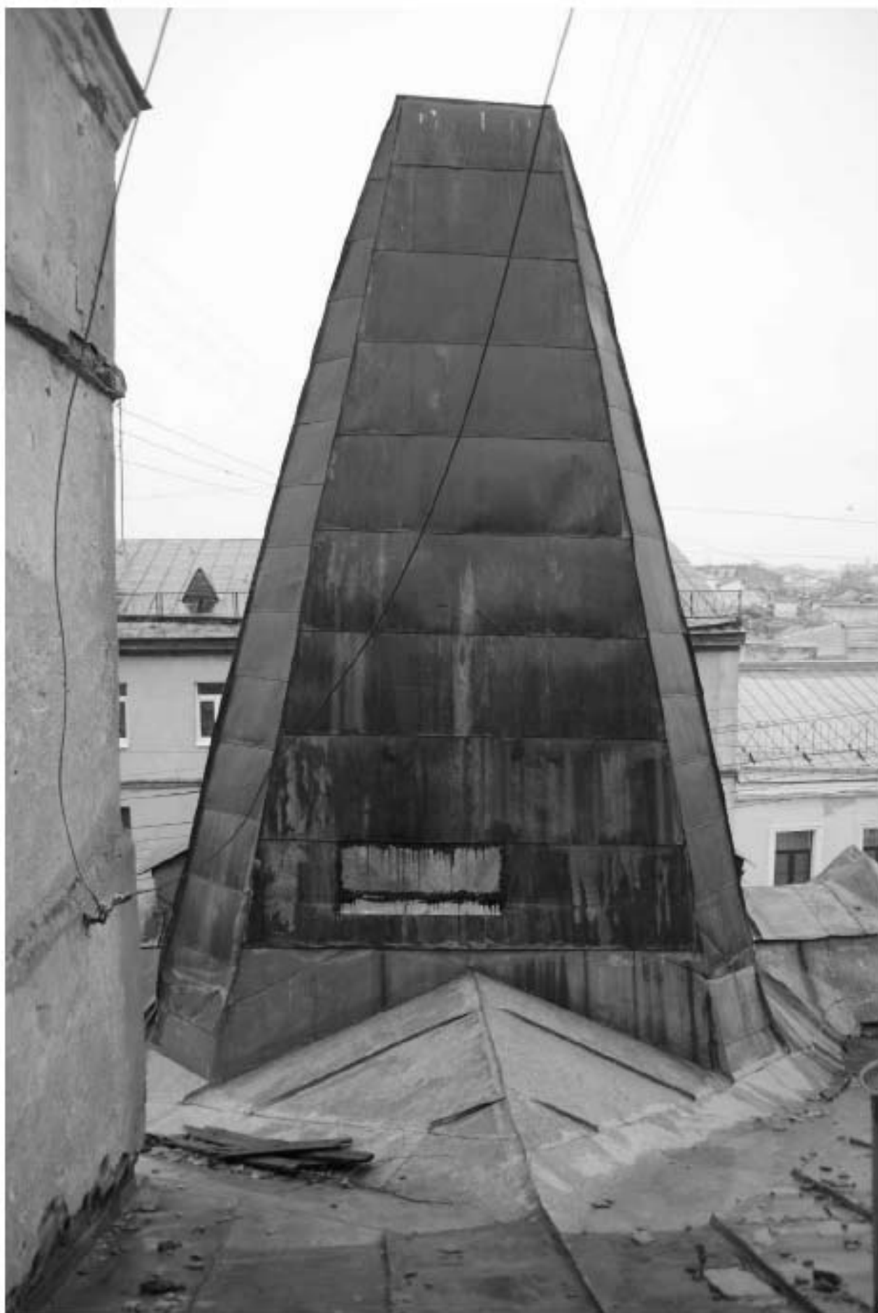
882. Чердак. Вид на кровлю.
