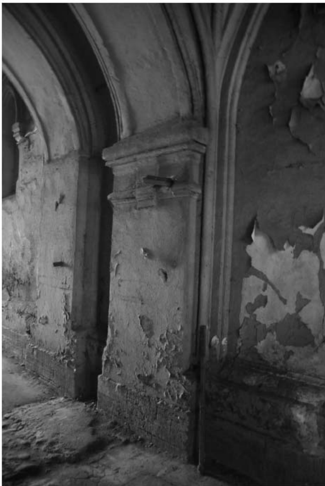
64. Воротный проезд лицевого корпуса. Фрагмент.
