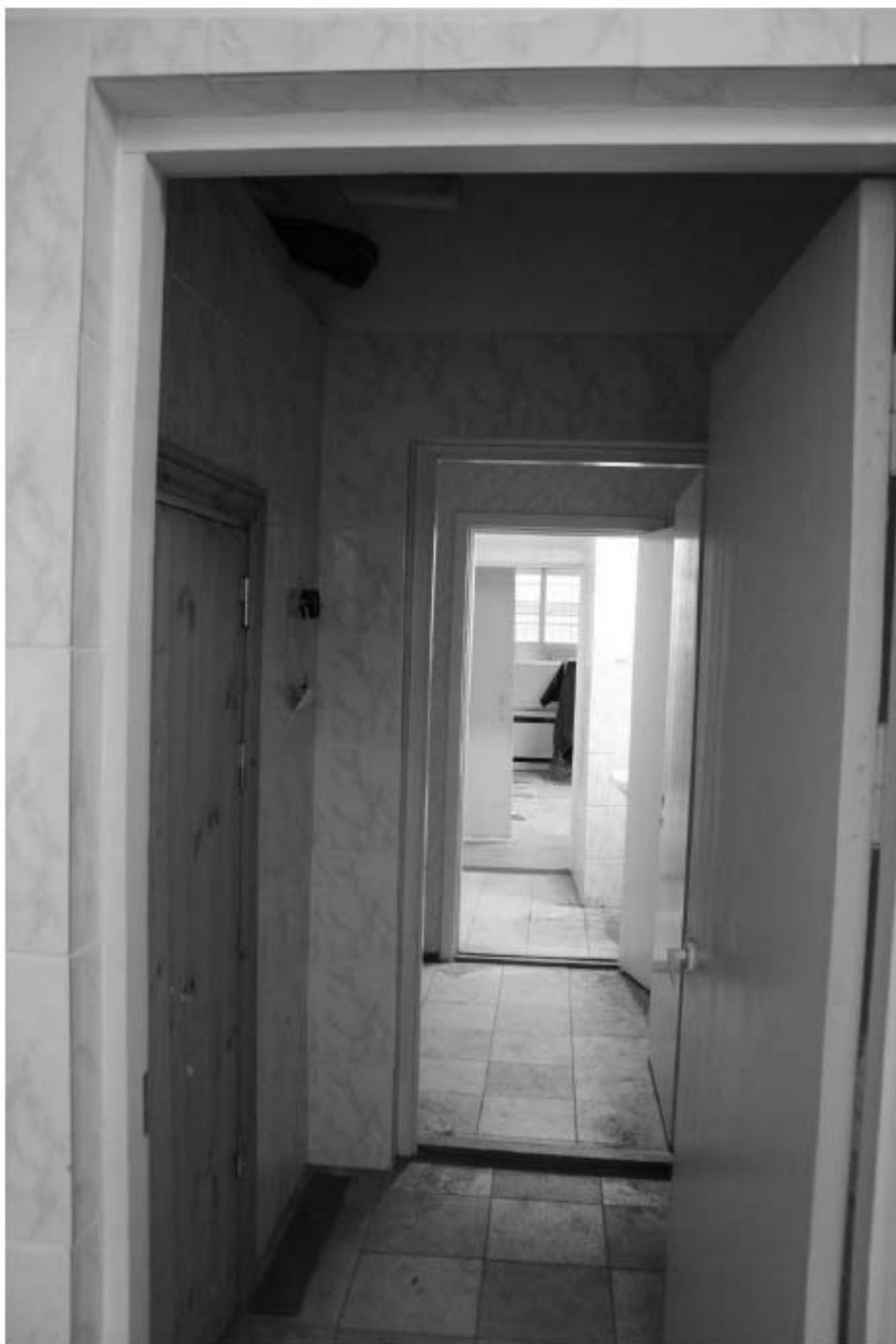
395. Этаж 1, помещение 15-Н. Интерьер душевой.
