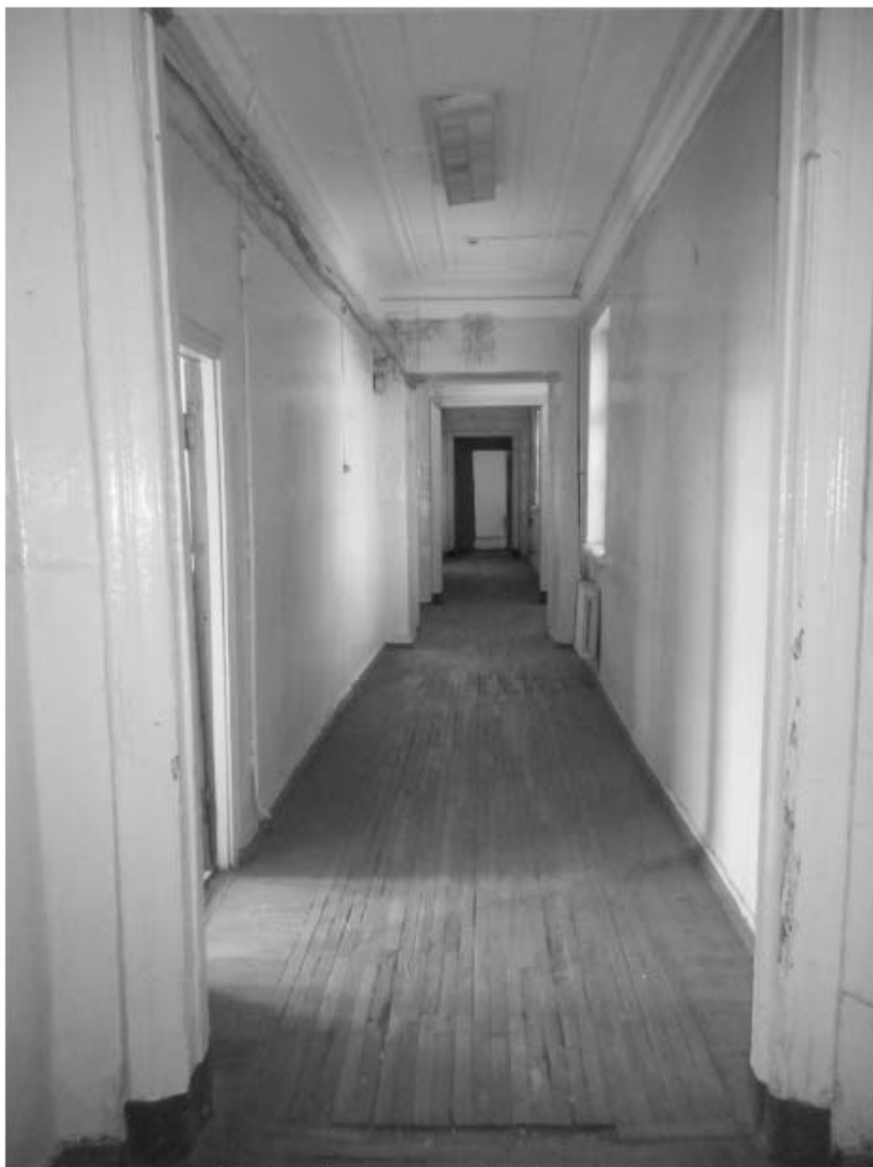
738. Этаж 4, помещение 40-Н. Вид коридора.
