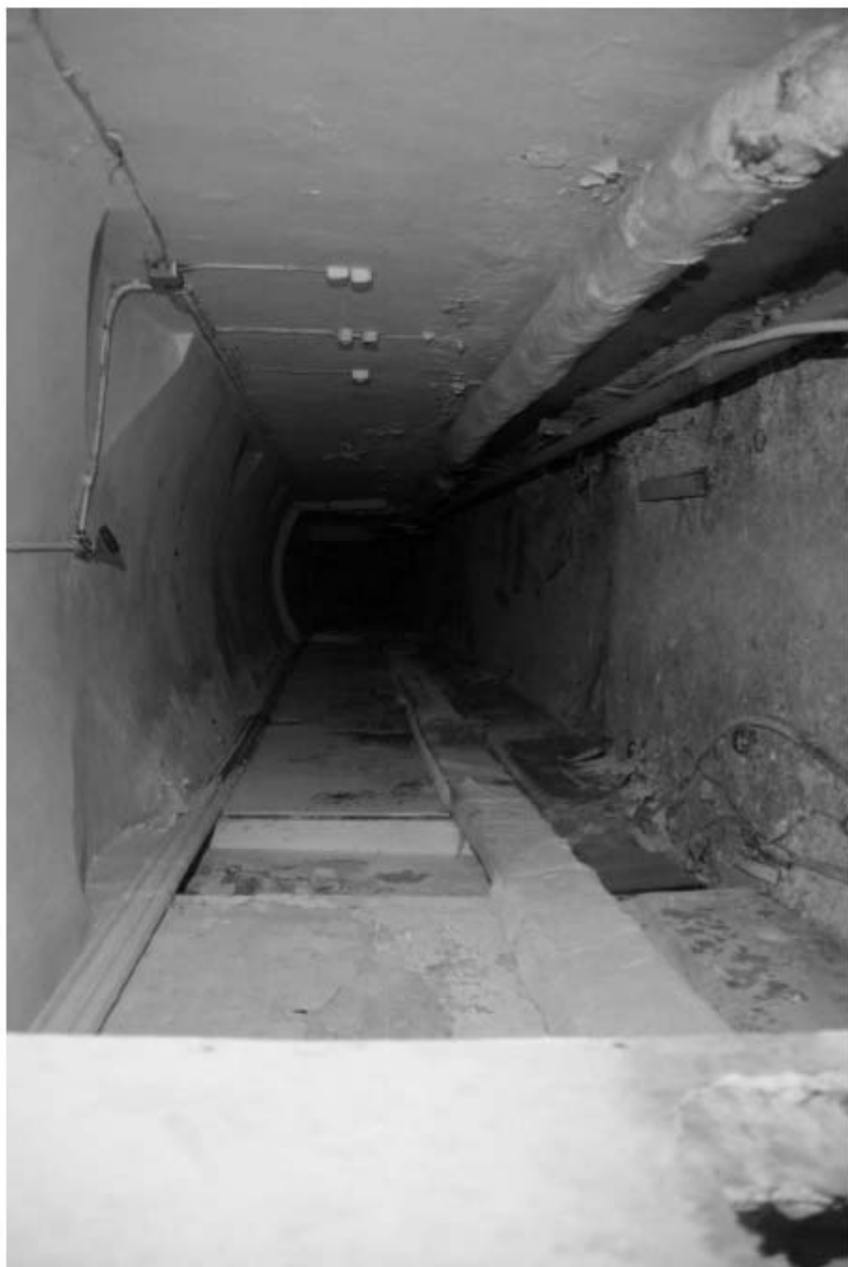
949. Подвал. Интерьер помещения 29-Н.
