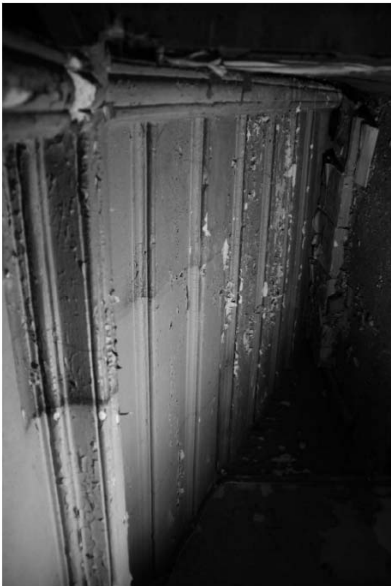
957. Подвал, помещение 6-Н. Лестница на 1 этаж.
