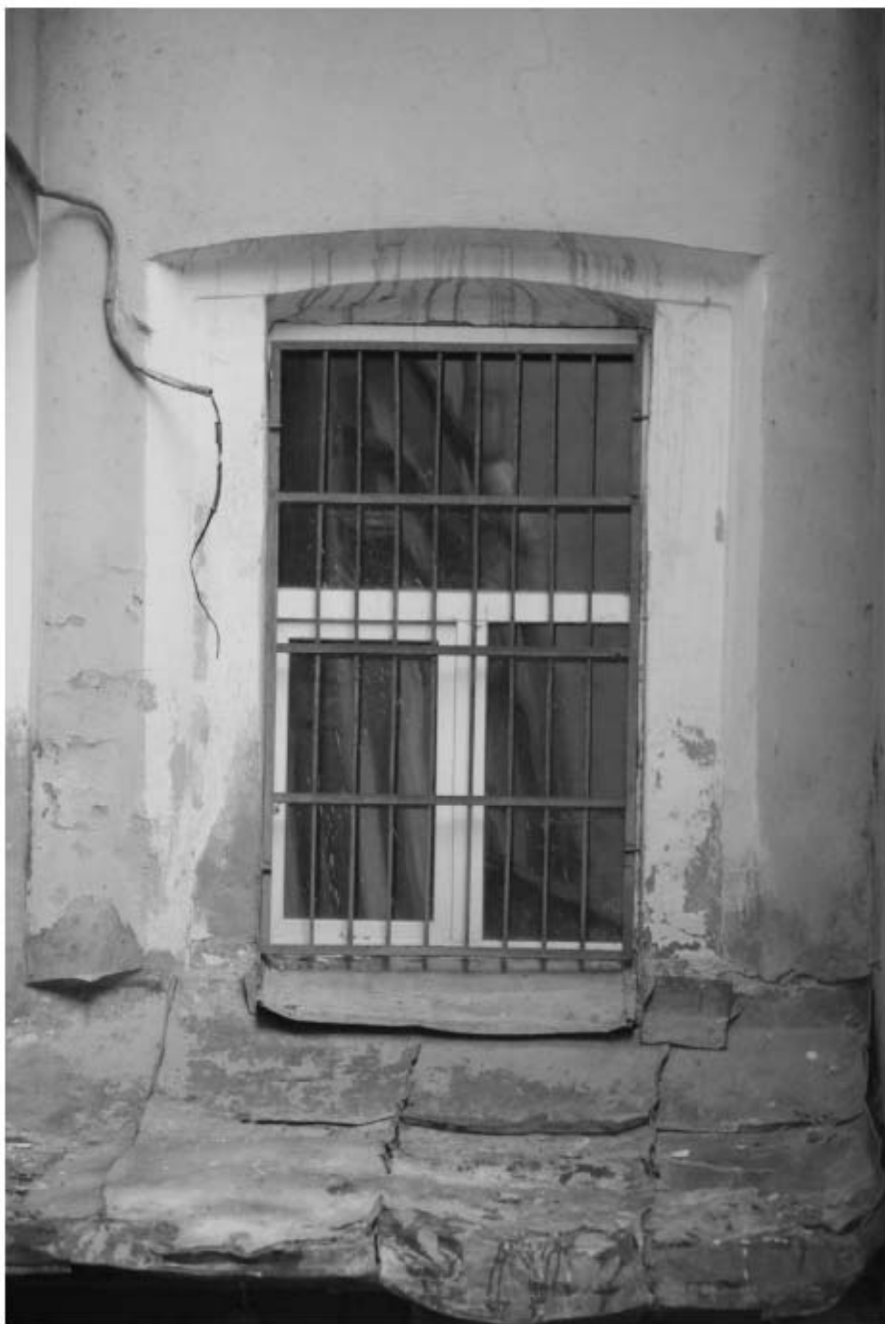
85. Фрагмент дворового фасада.
