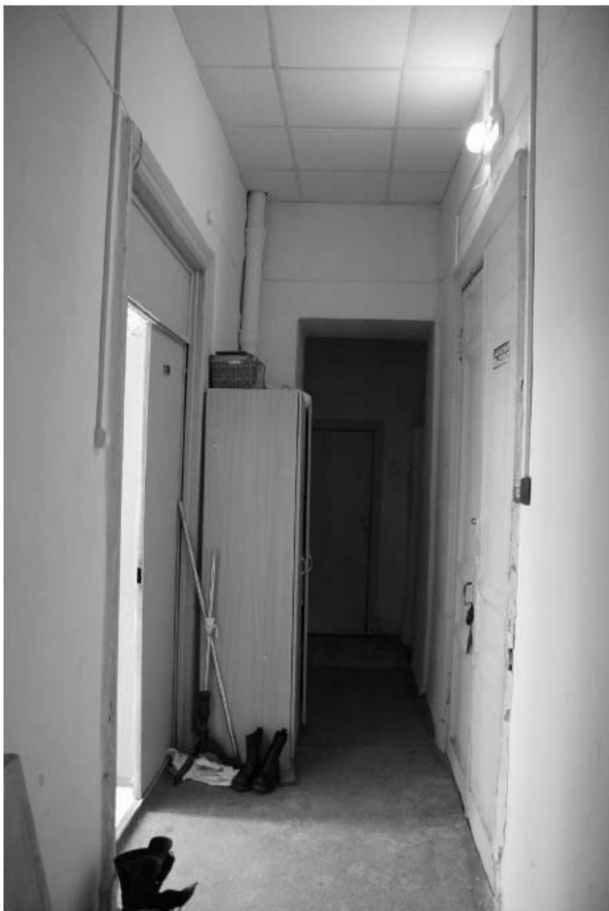
574. Этаж 2, помещение 16-Н. Вид коридора.
