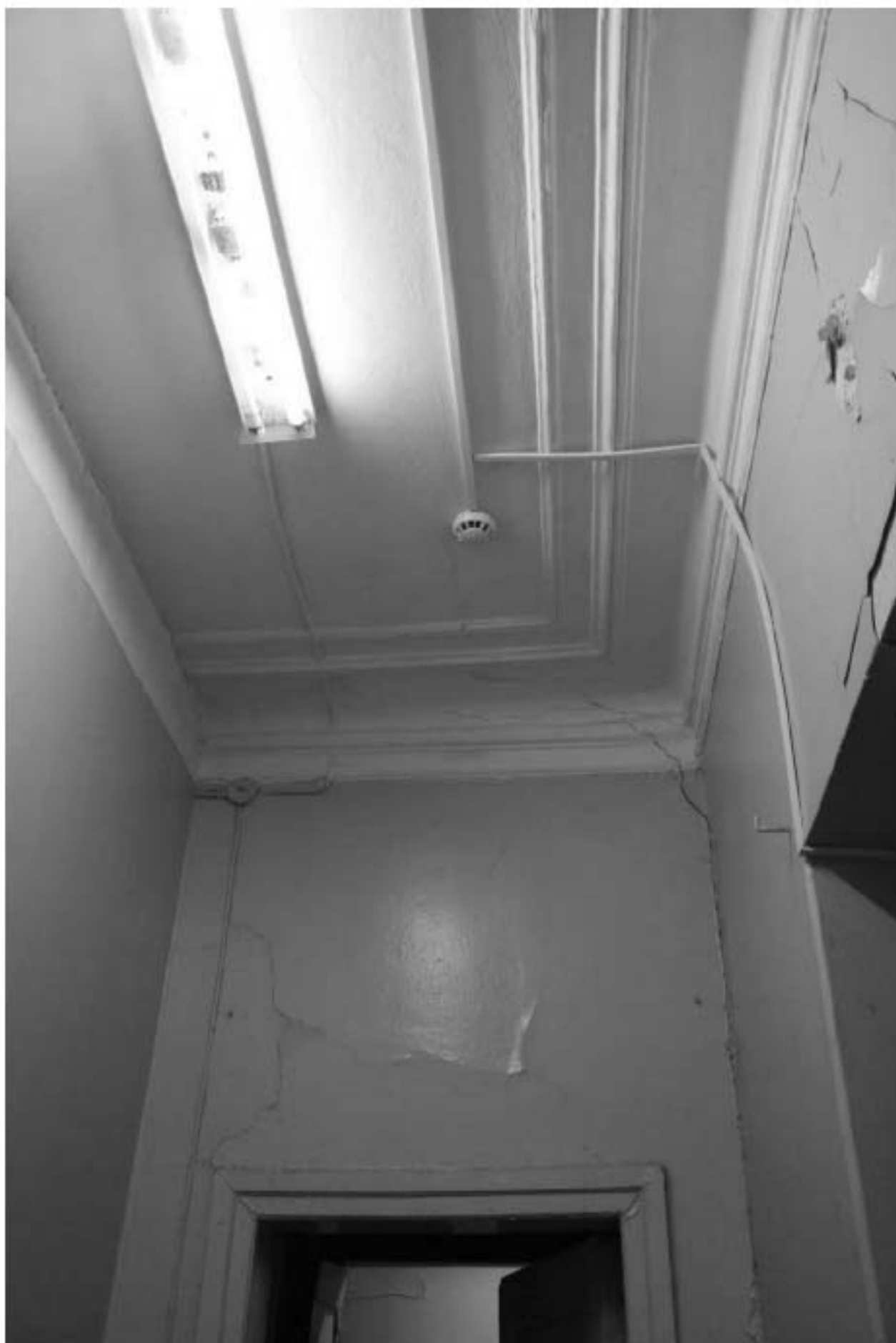
259. Этаж 1, помещение 20-Н. Потолок комнаты 5,6 кв.м.
