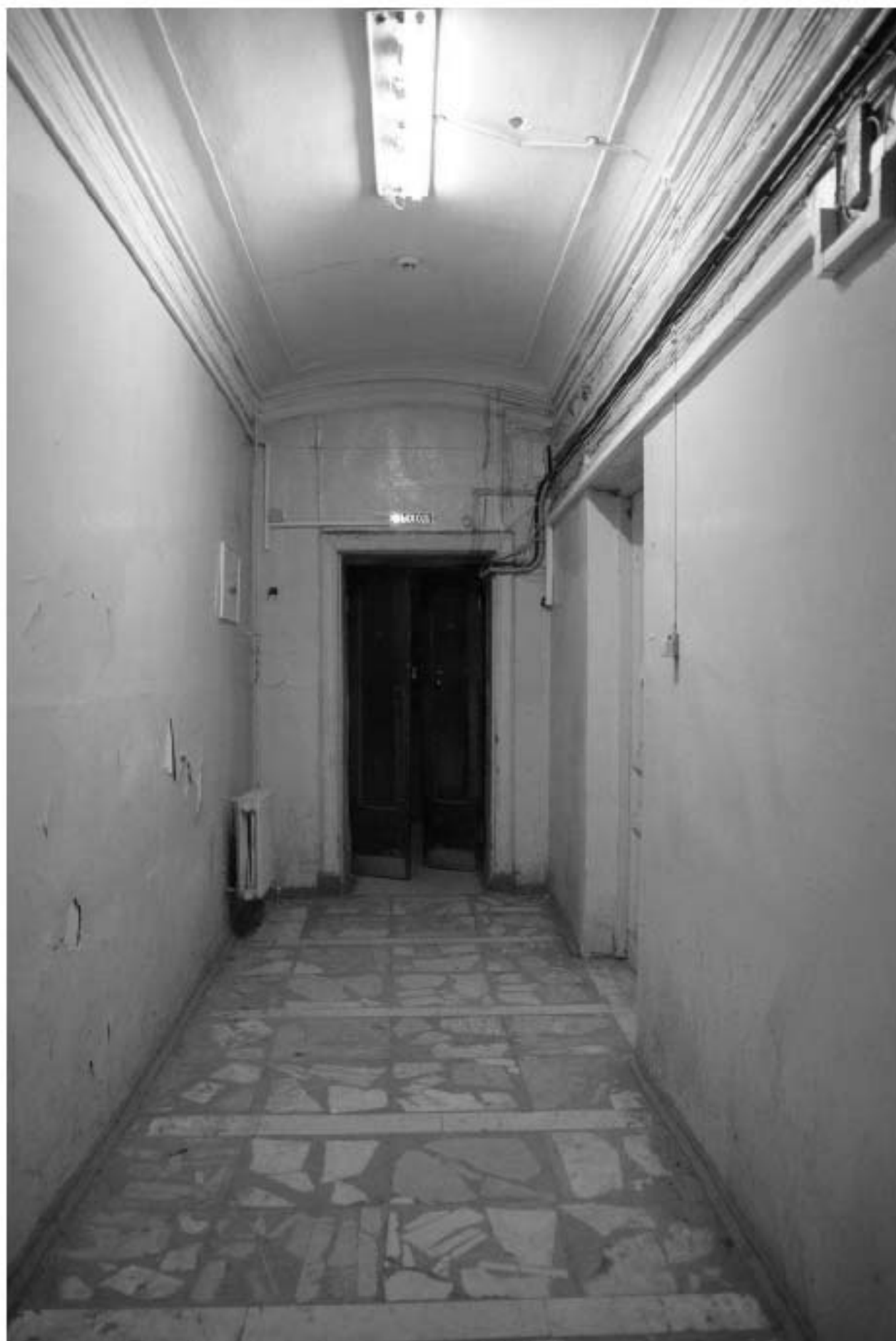
314. Этаж 1, помещение 15-Н. Вид коридора.
