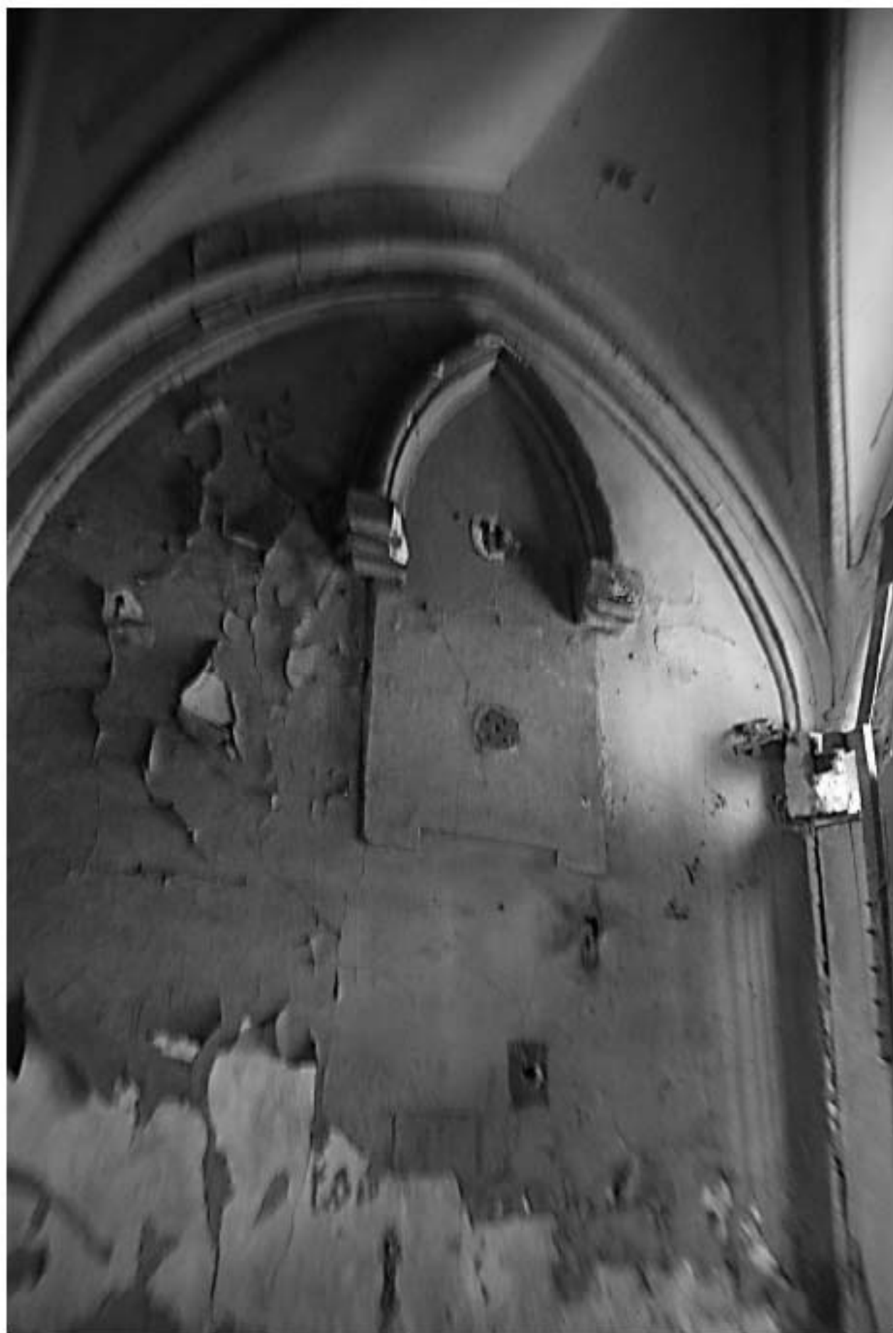
63. Воротный проезд лицевого корпуса. Фрагмент.
