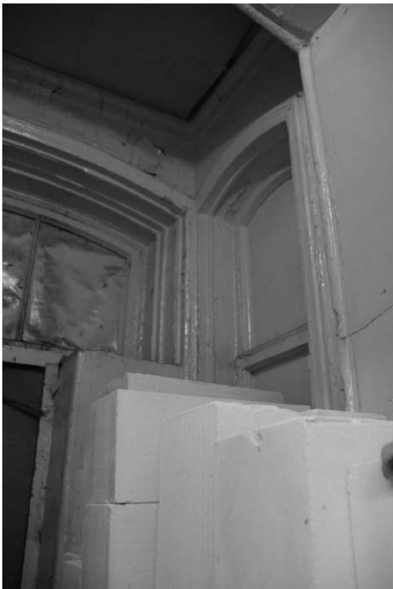
271. Этаж 1, помещение 20-Н. Интерьер входной группы.
