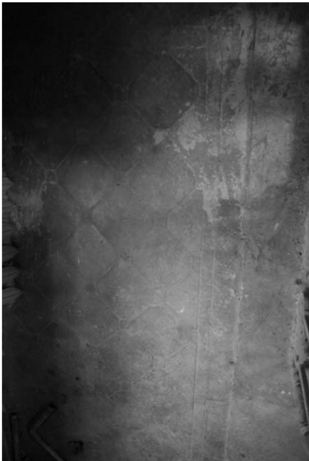
1092. Лестница 3ЛК. Покрытие лестничной площадки.
