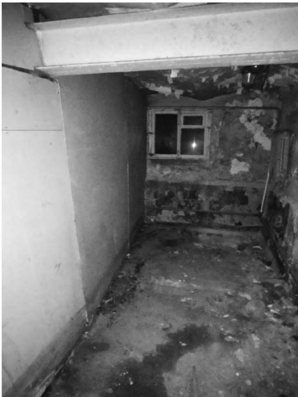
1003. Подвал, помещение 6-Н. Интерьер комнаты 14,9 кв.м.
