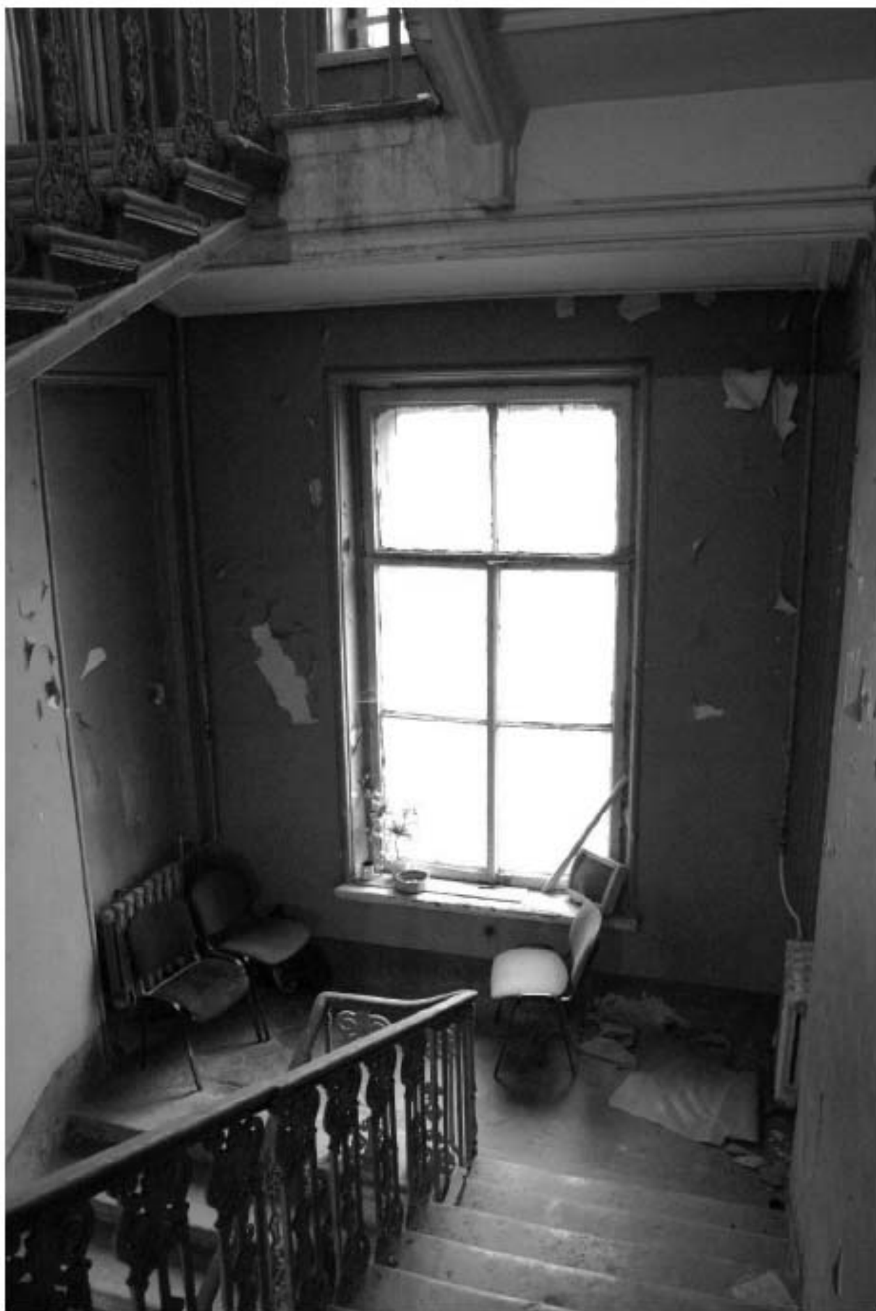
1496. Лестница 3ЛК. Вид лестничной площадки между 2 и 3 этажом.
