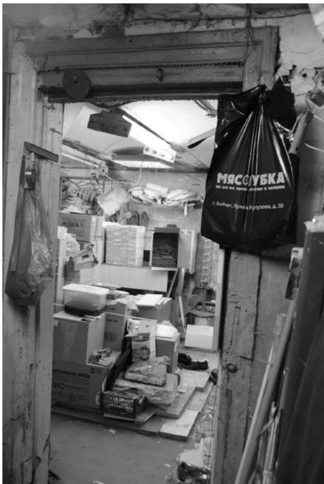
1032. Подвал, помещение 2-Н. Вход в комнату 18,4 кв.м.
