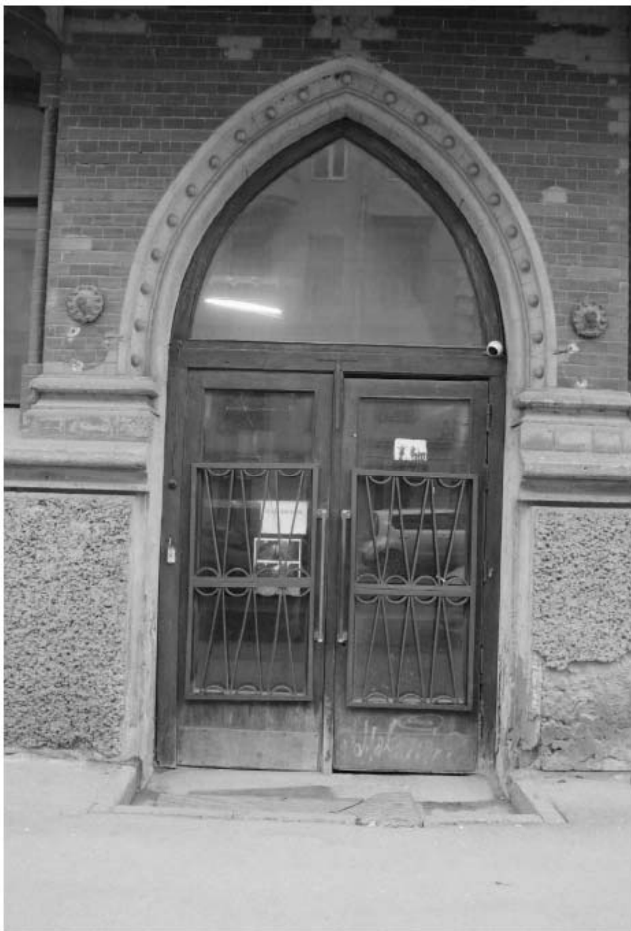
30. Фрагмент лицевого фасада. Вид на парадный вход.
