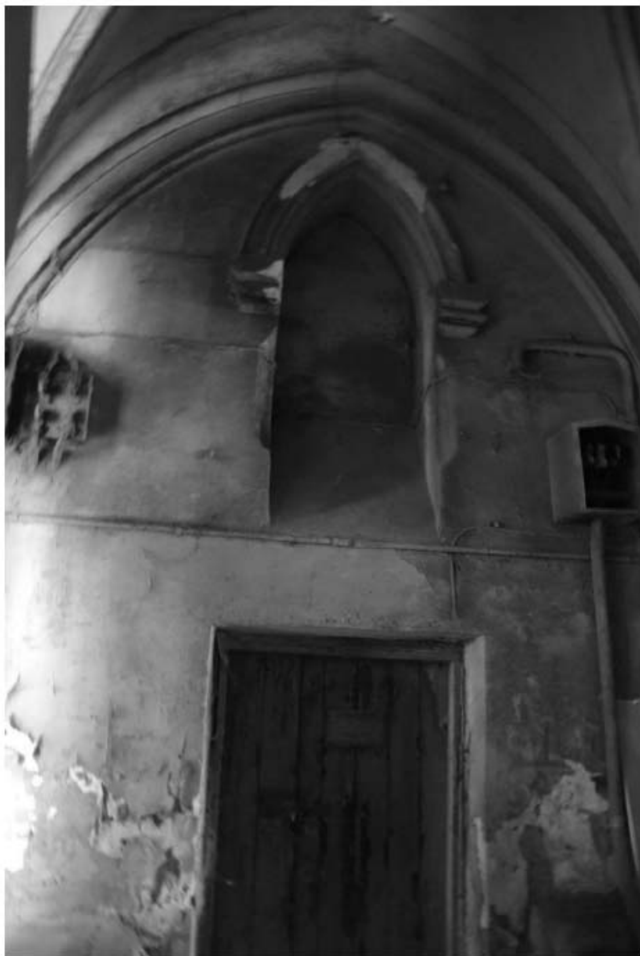
66. Воротный проезд лицевого корпуса. Фрагмент.
