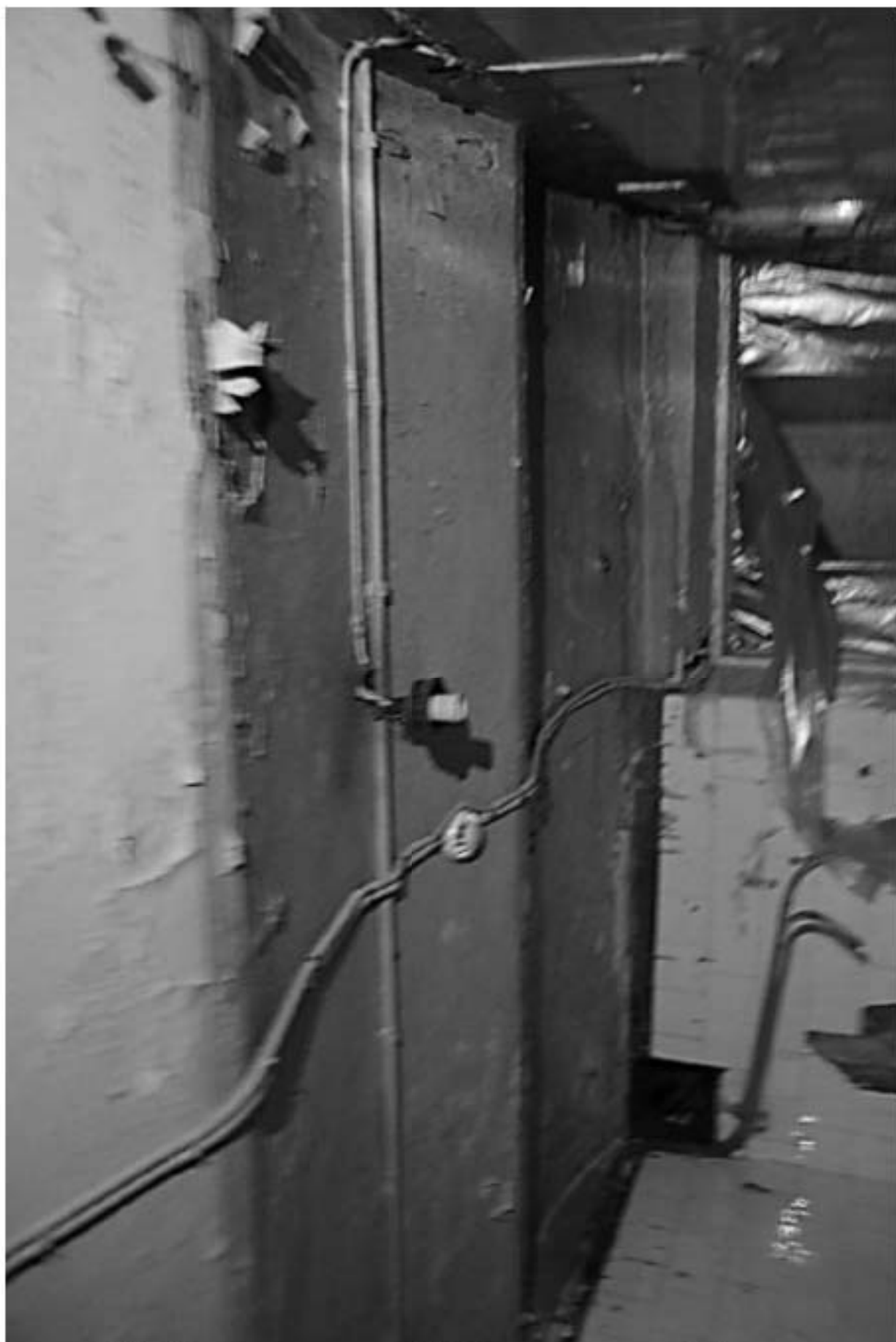
976. Подвал, помещение 6-Н. Интерьер комнаты 14,2 кв.м.
