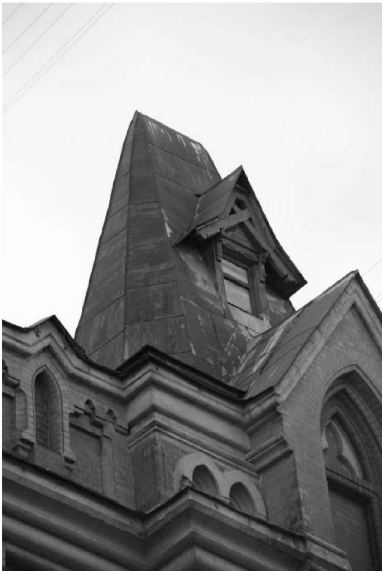
26. Вид на башенку кровли.
