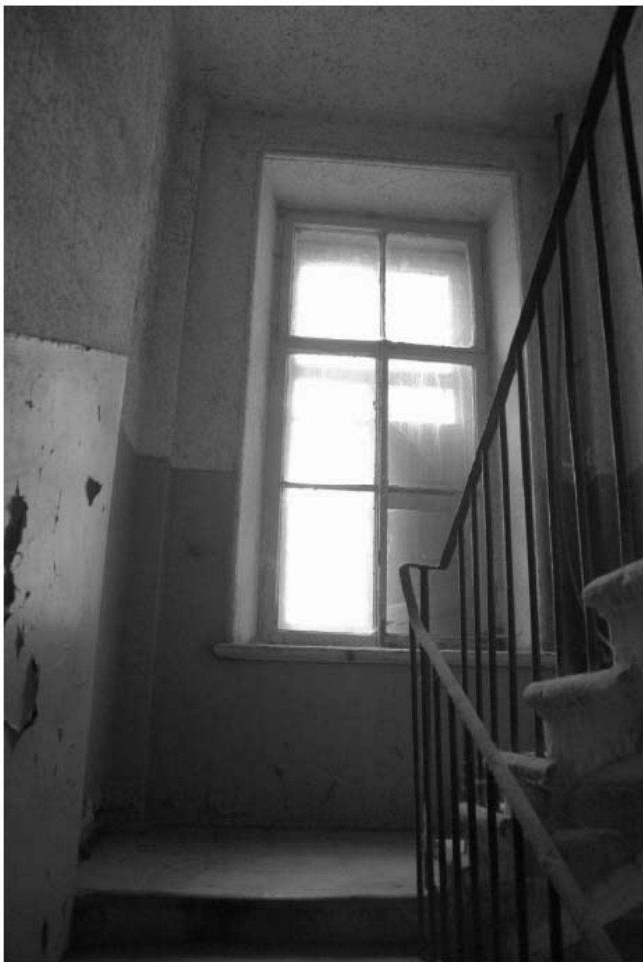
233. Лестница 4ЛК. Лестничная площадка между 3 и 4 этажами.
