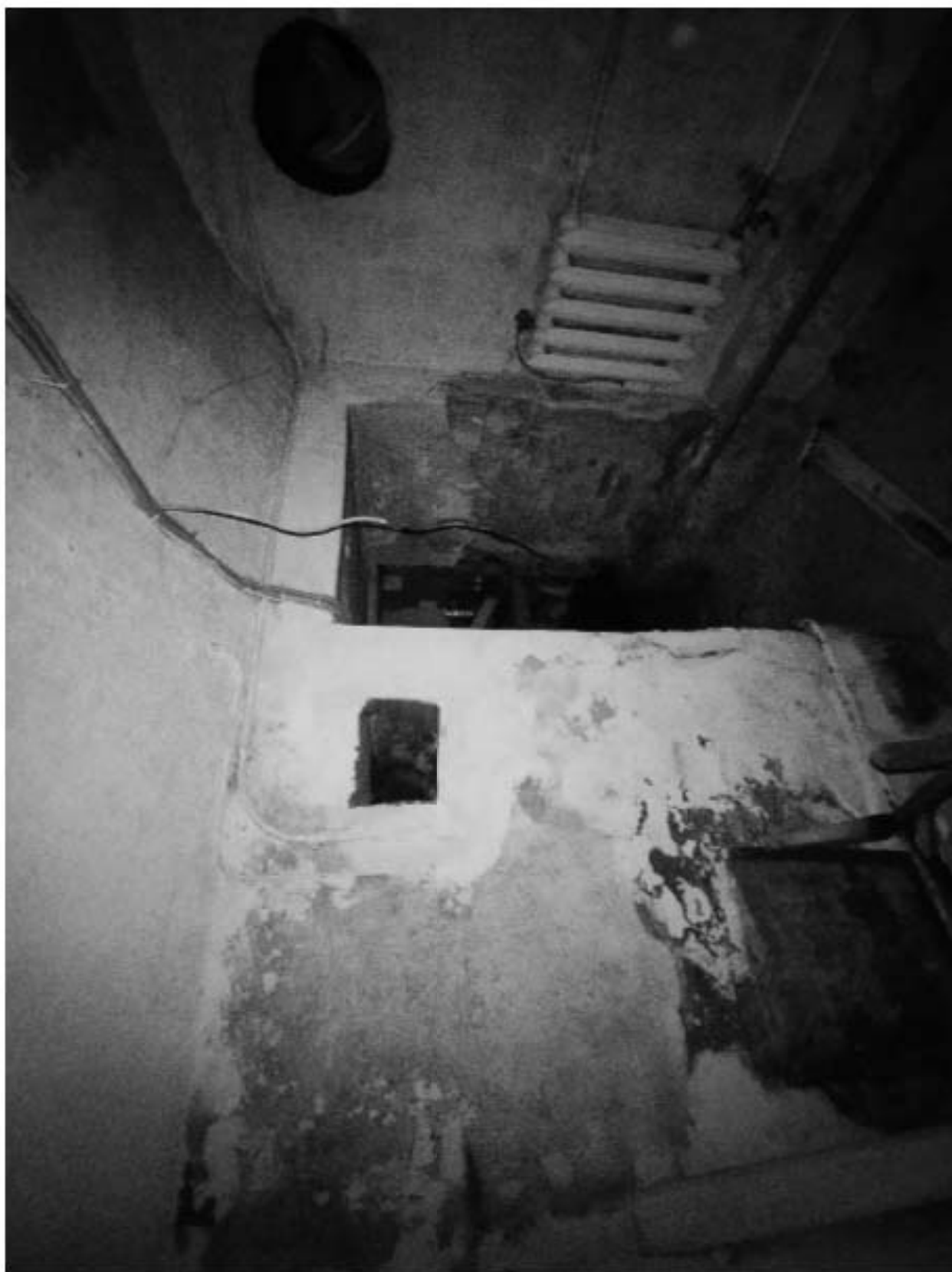
996. Подвал, помещение 6-Н. Интерьер комнаты 4,3 кв.м.
