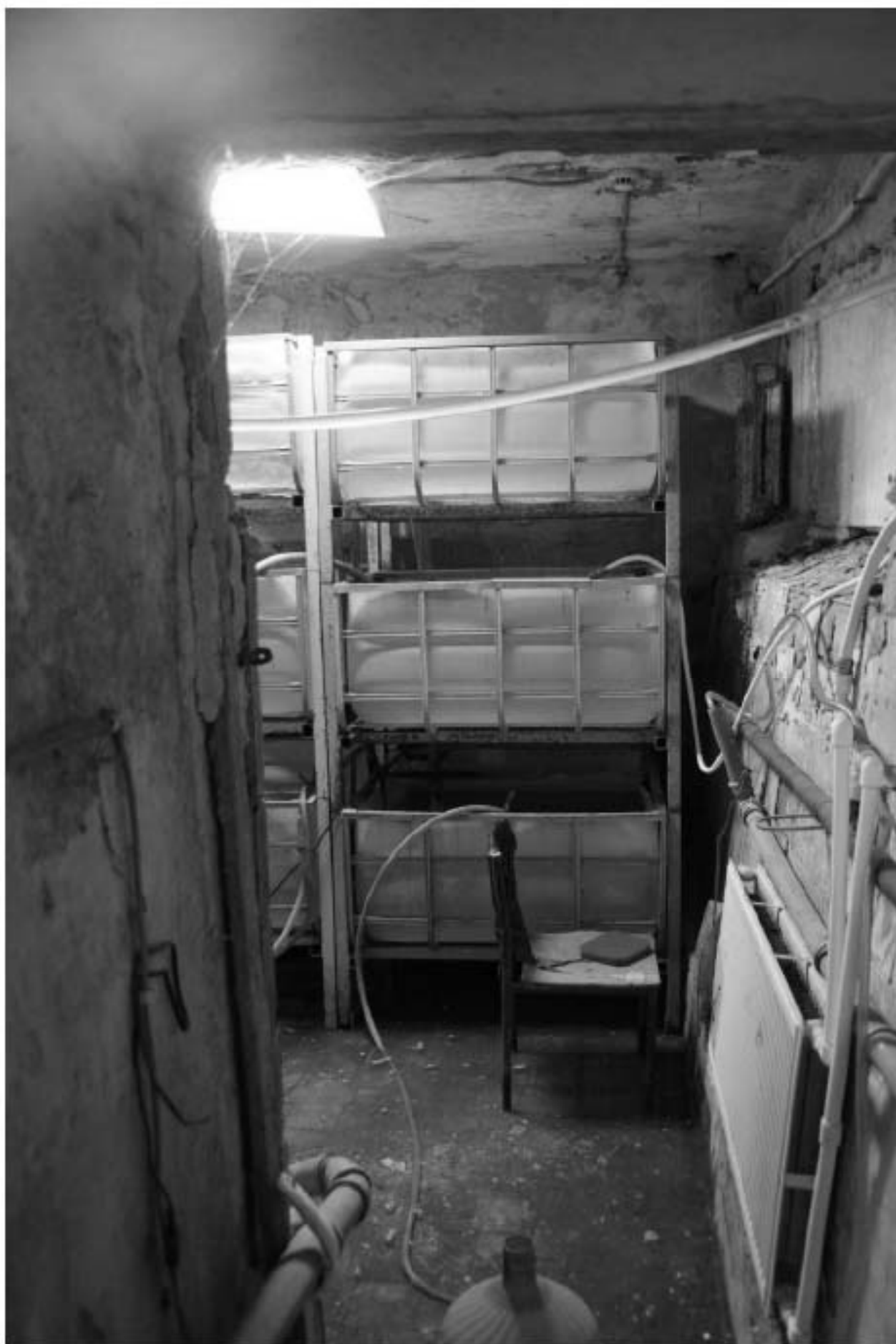
1044. Подвал, помещение 2-Н. Вход в комнату 20,1 кв.м.
