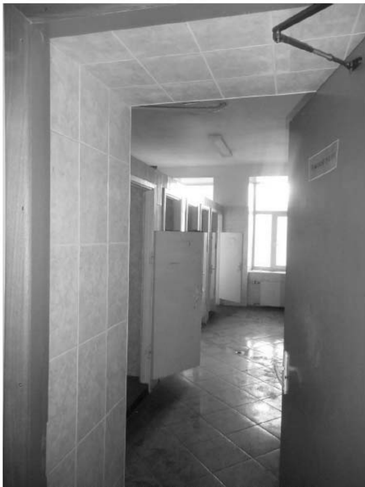
783. Этаж 4, помещение 40-Н. Вход в комнату 21,8 кв.м.
