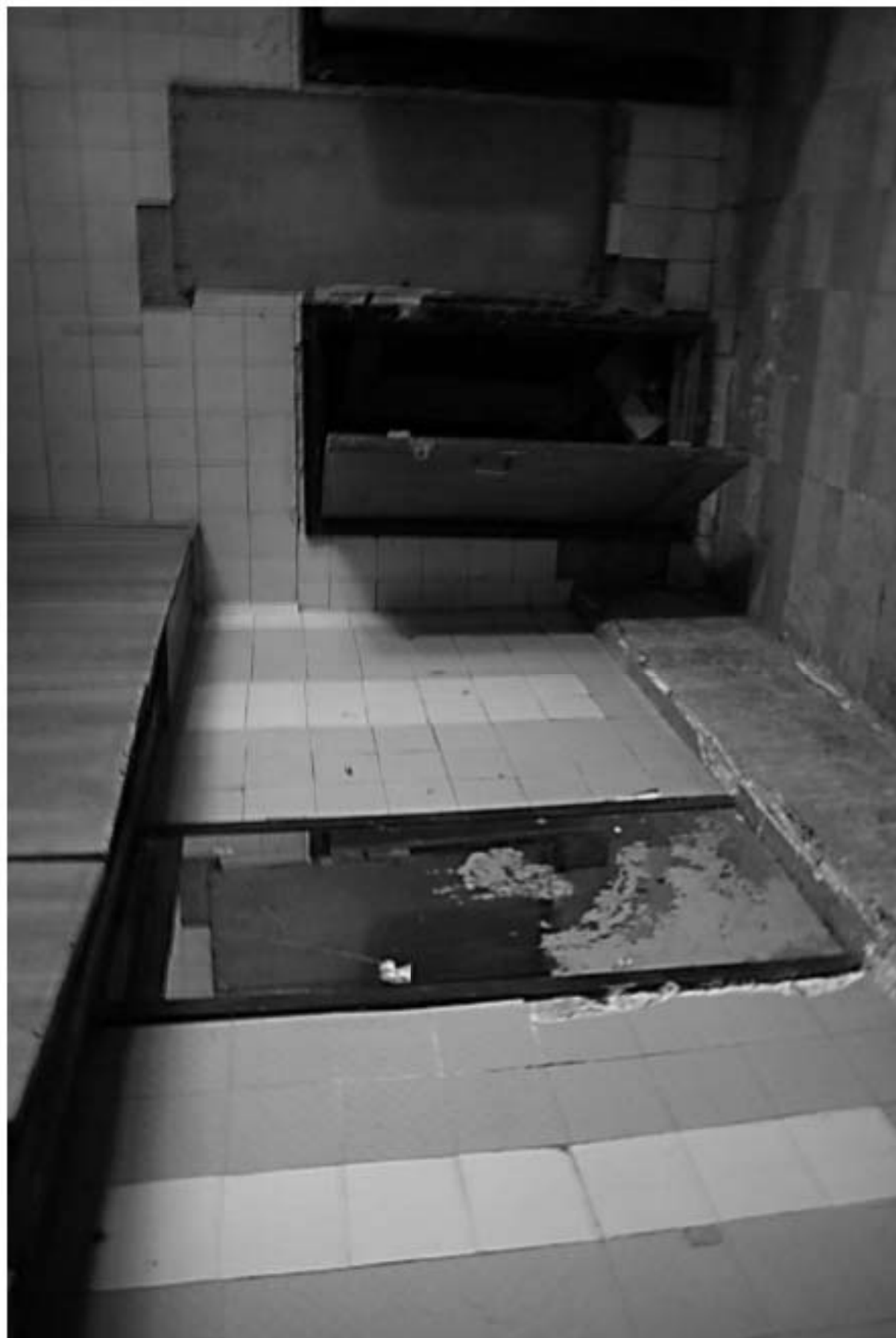
939. Лестничная площадка входа в подвал.
