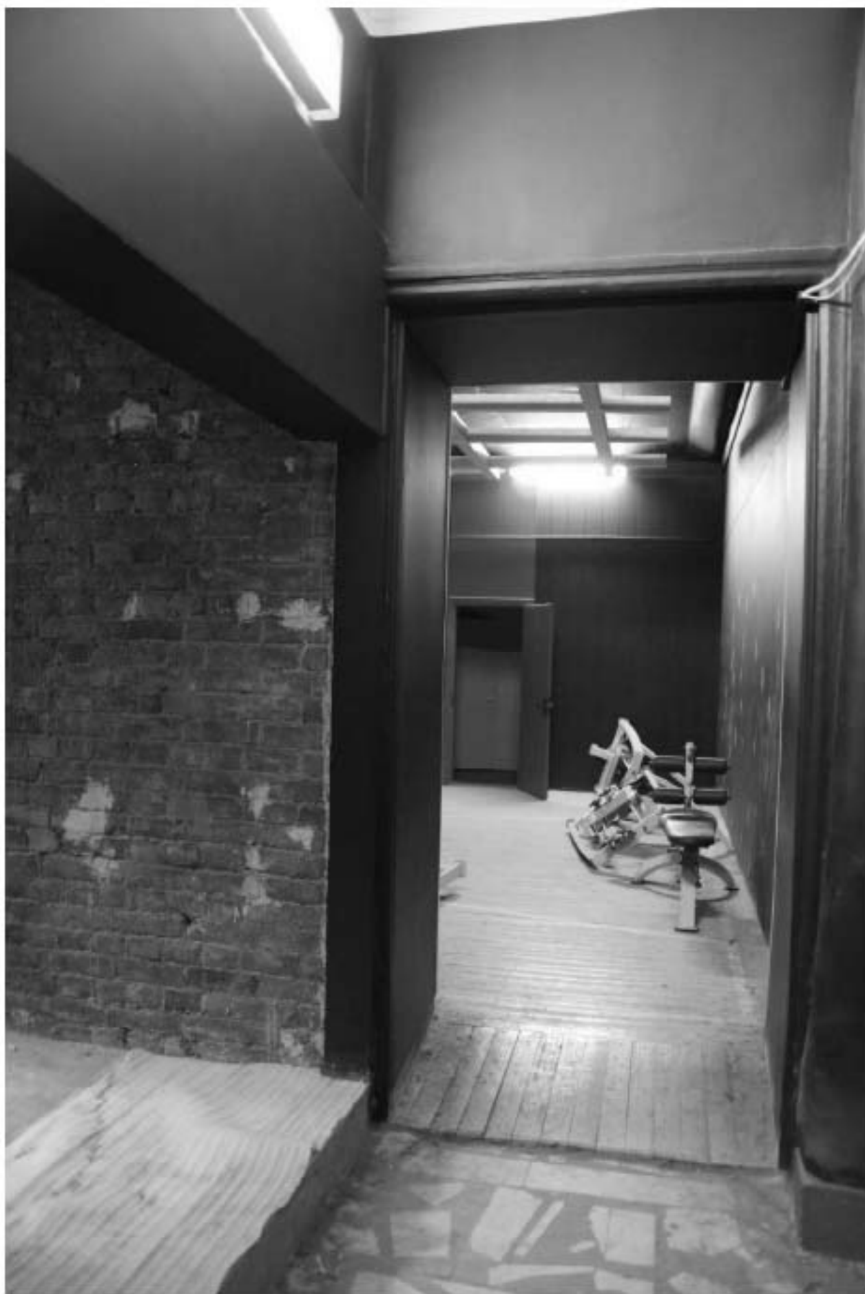
345. Этаж 1, помещение 15-Н. Комната 3,7 кв.м.
