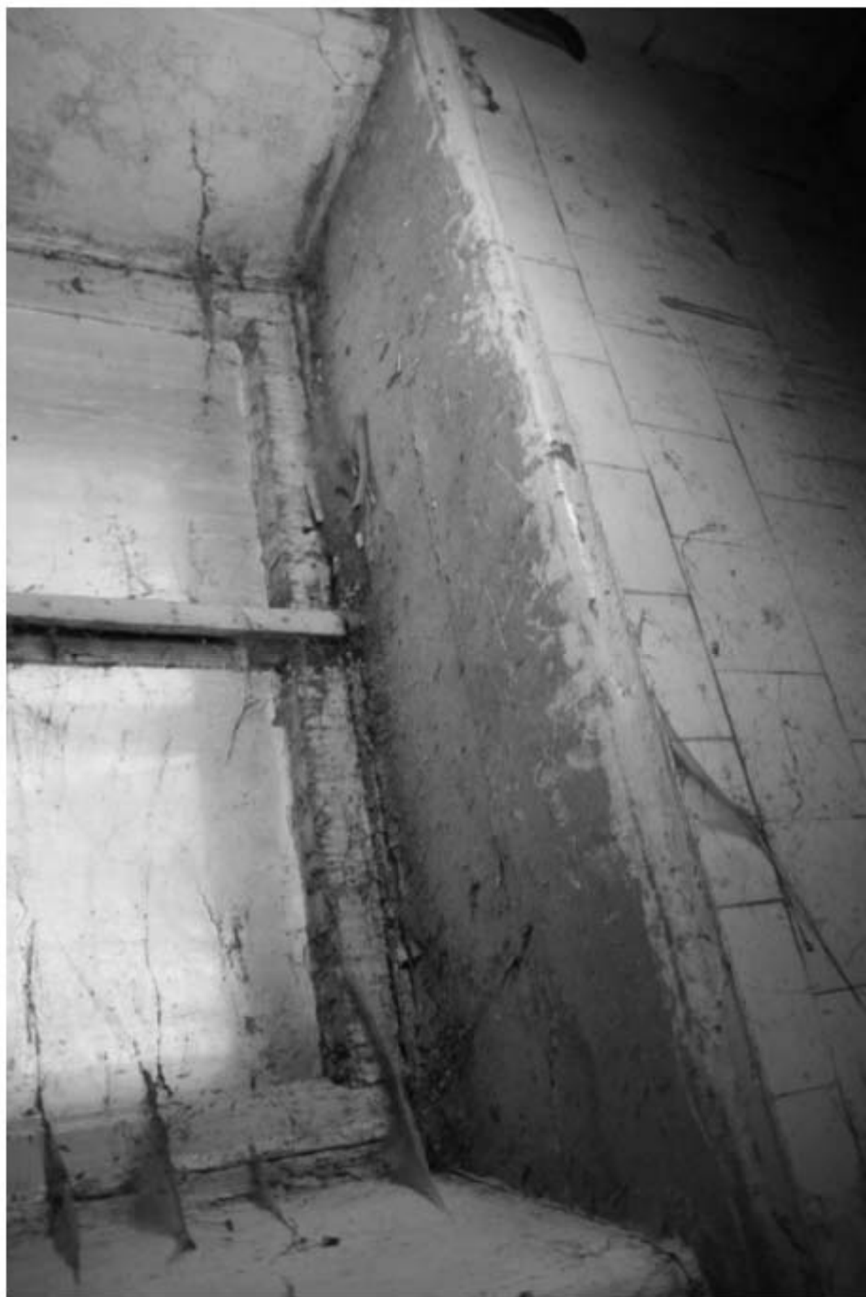
222. Лестница 4ЛК. Деревянный подоконник.
