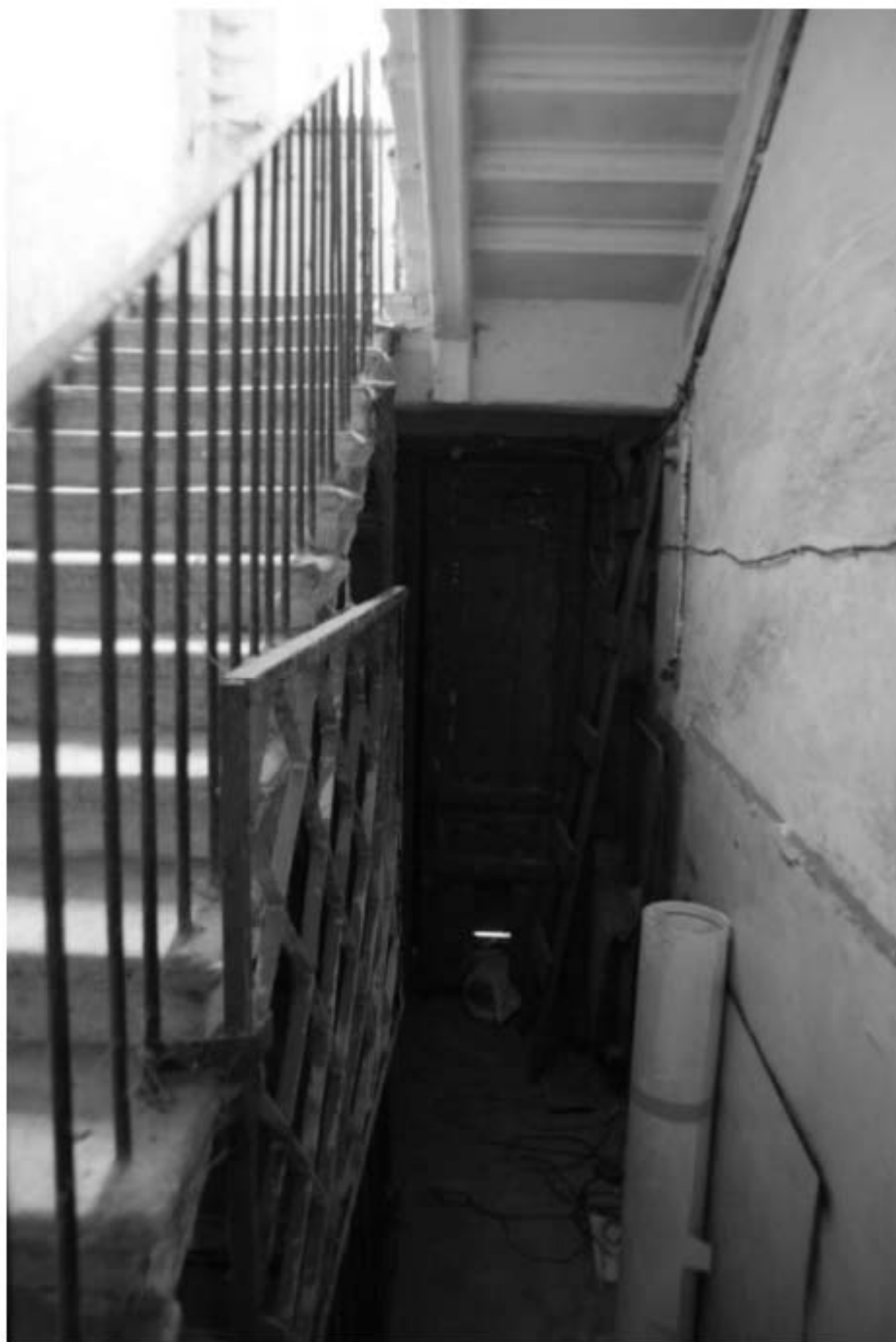
217. Лестница 4ЛК. Вид на входную дверь.
