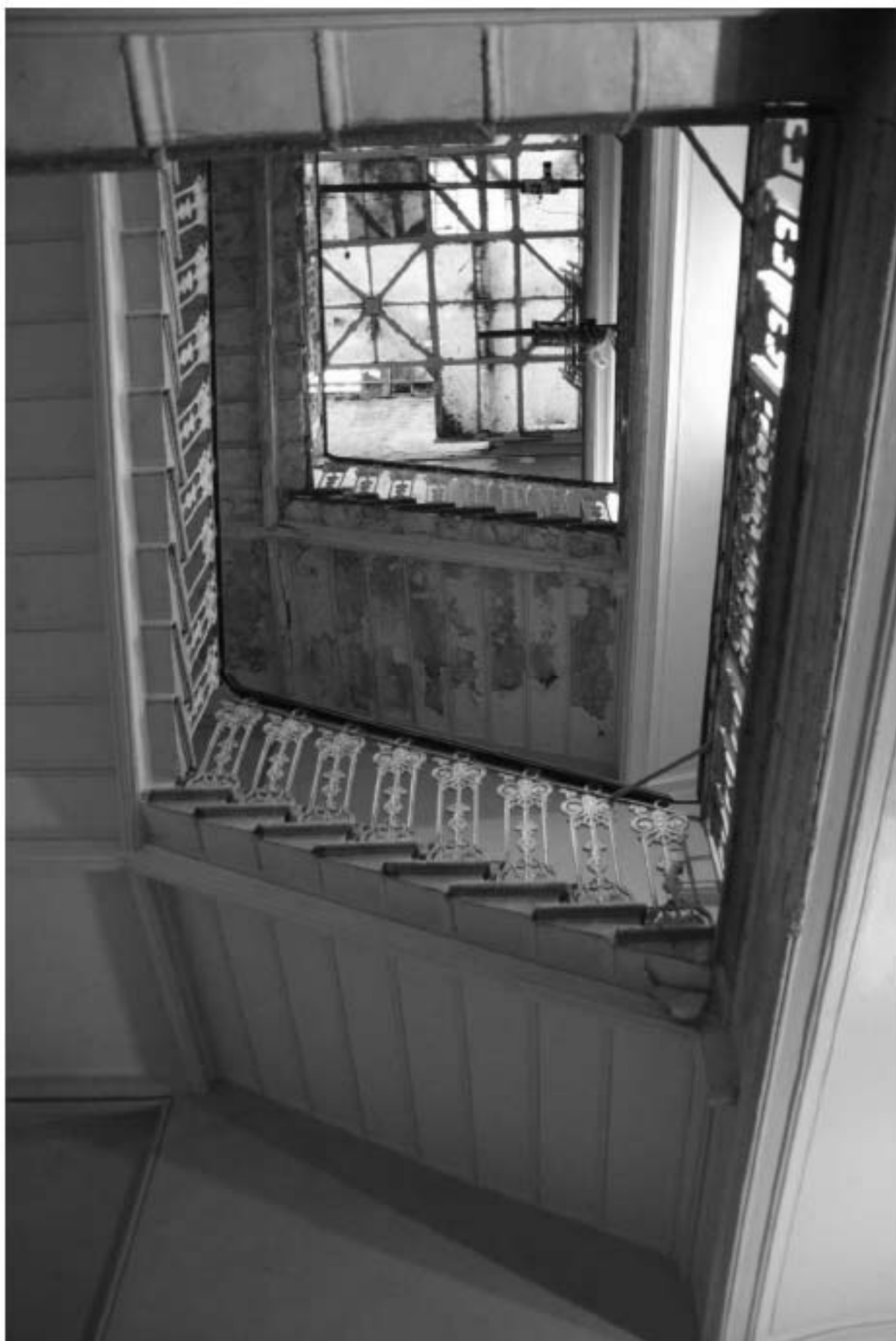
141. Вид на пространство лестницы и световой фонарь.
