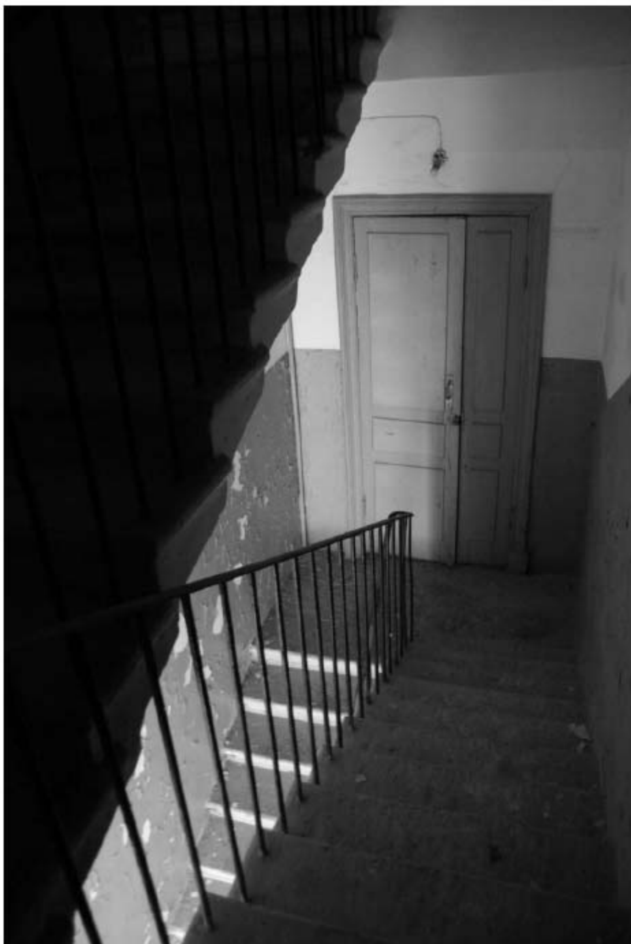
1579. Лестница 2ЛК. Вид на лестничную площадку 5 этажа.
