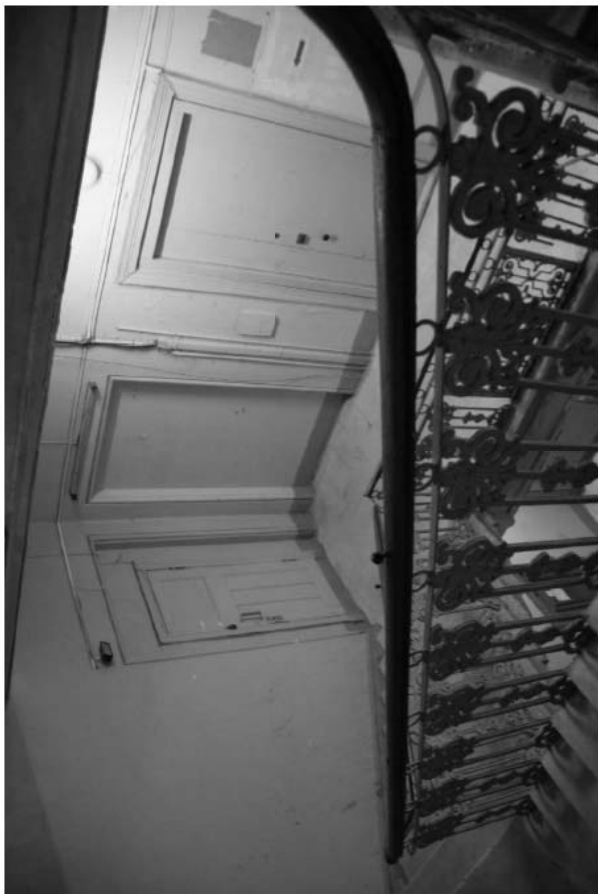
144. Вид на лестничную площадку 3 этажа.
