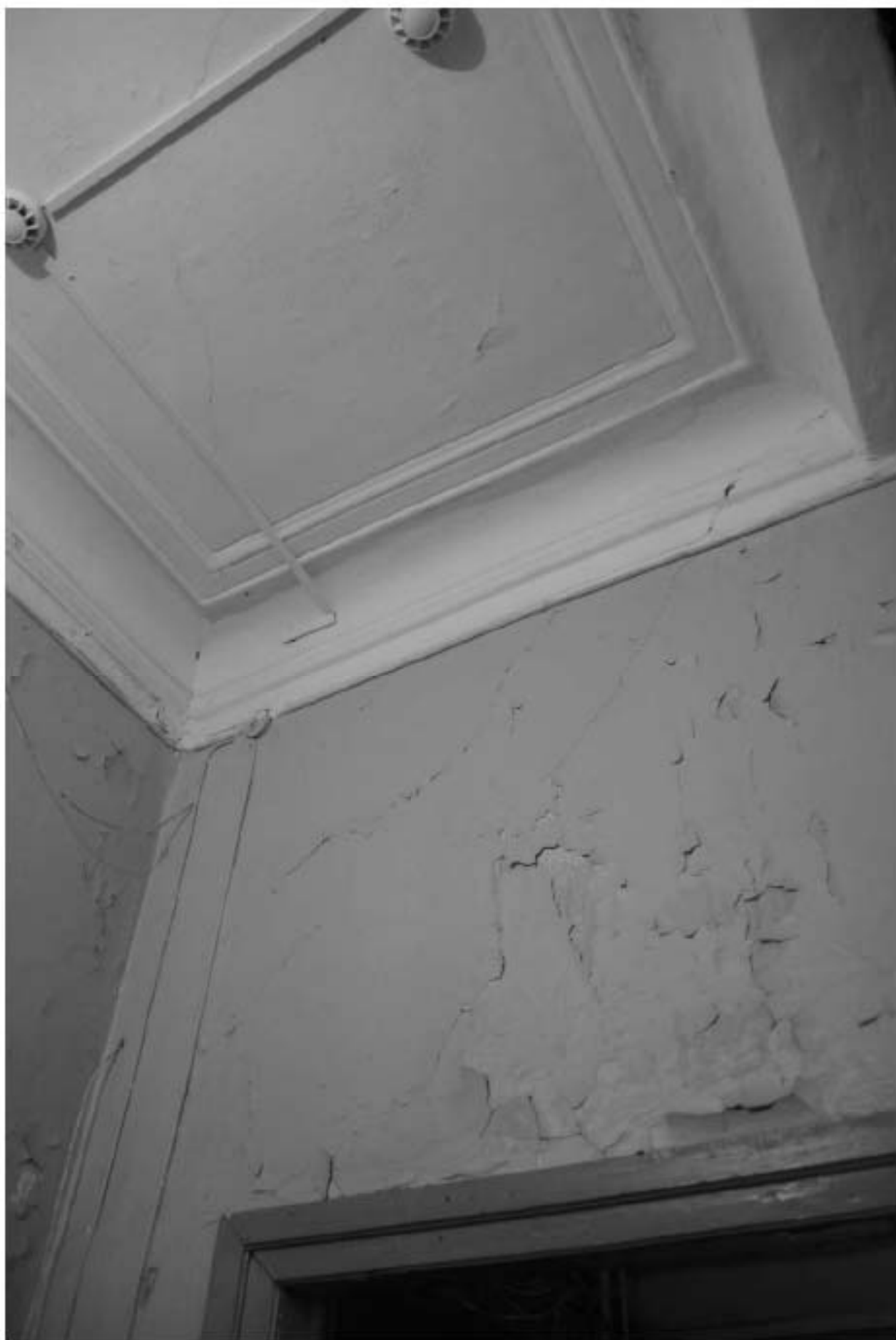
250. Этаж 1, помещение 20-Н. Потолок комнаты 3,6 кв.м.
