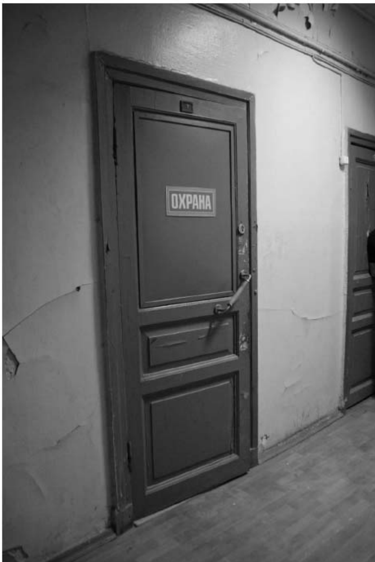
251. Этаж 1, помещение 20-Н. Входная дверь в комнату 10,3 кв.м.
