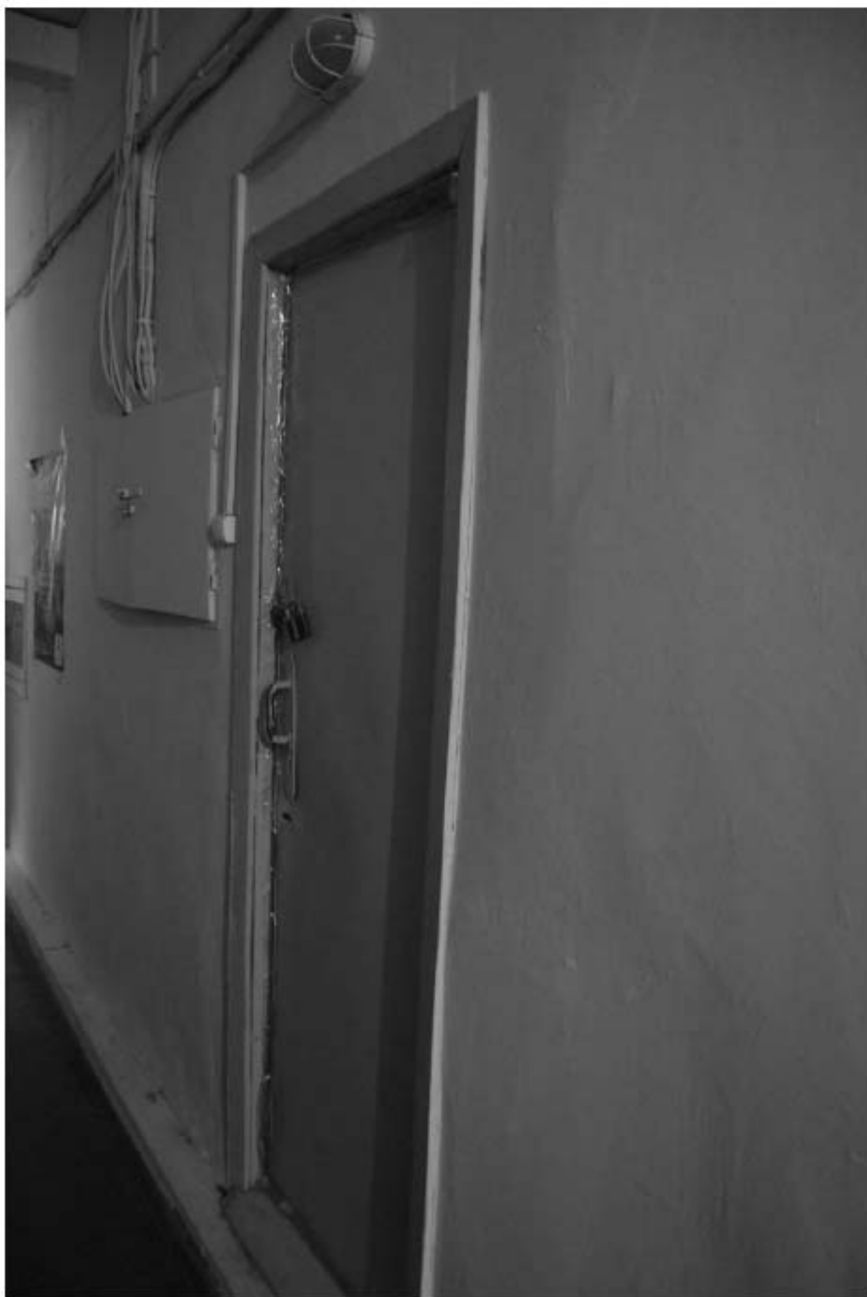
551. Этаж 2, помещение 16-Н. Вид коридора.
