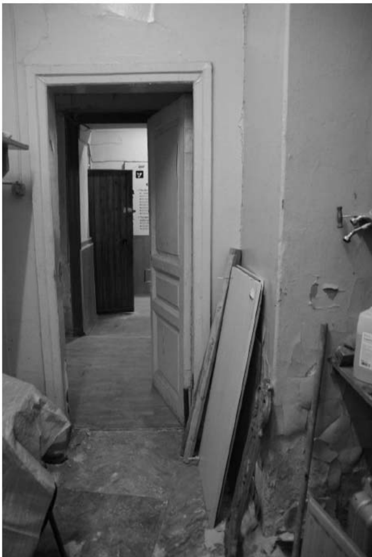
260. Этаж 1, помещение 20-Н. Вид из комнаты 5,6 кв.м. в коридор.
