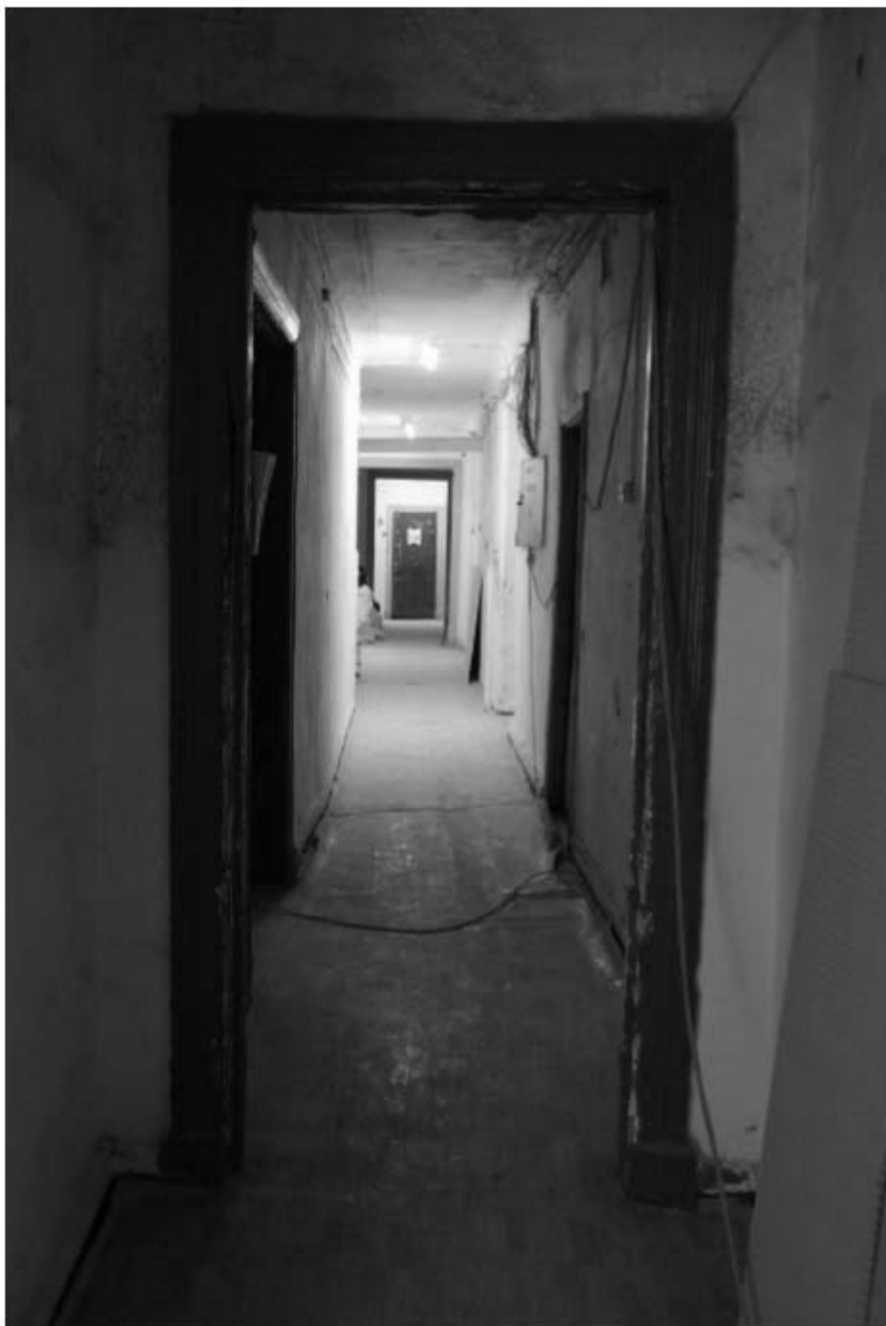
828. Этаж 5, помещение 19-Н. Вид коридора.
