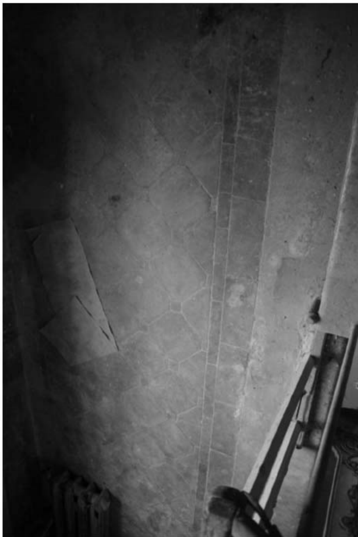
205. Лестница 3ЛК. Покрытие лестничной площадки.
