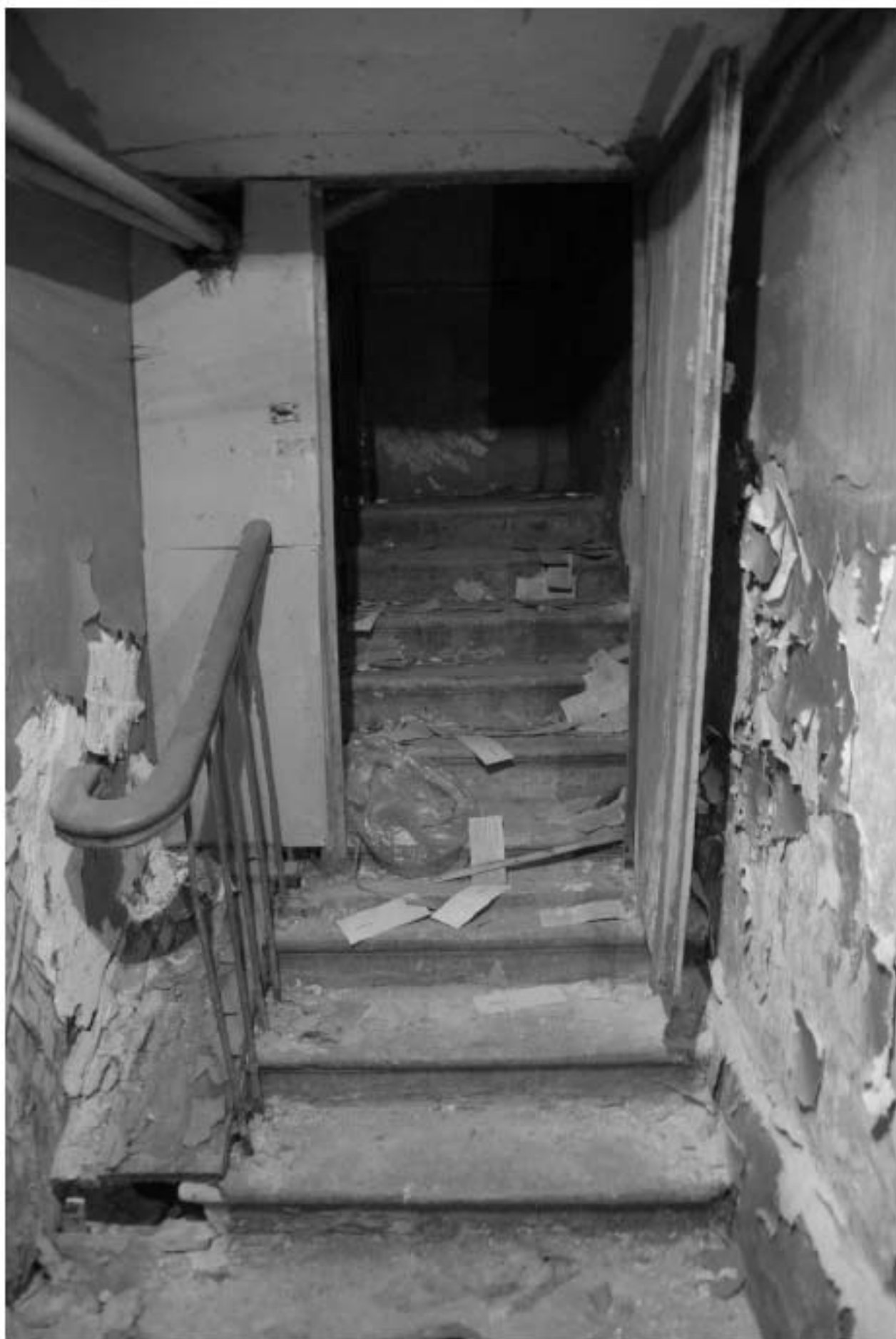
953. Подвал, помещение 6-Н. Лестница на 1 этаж.
