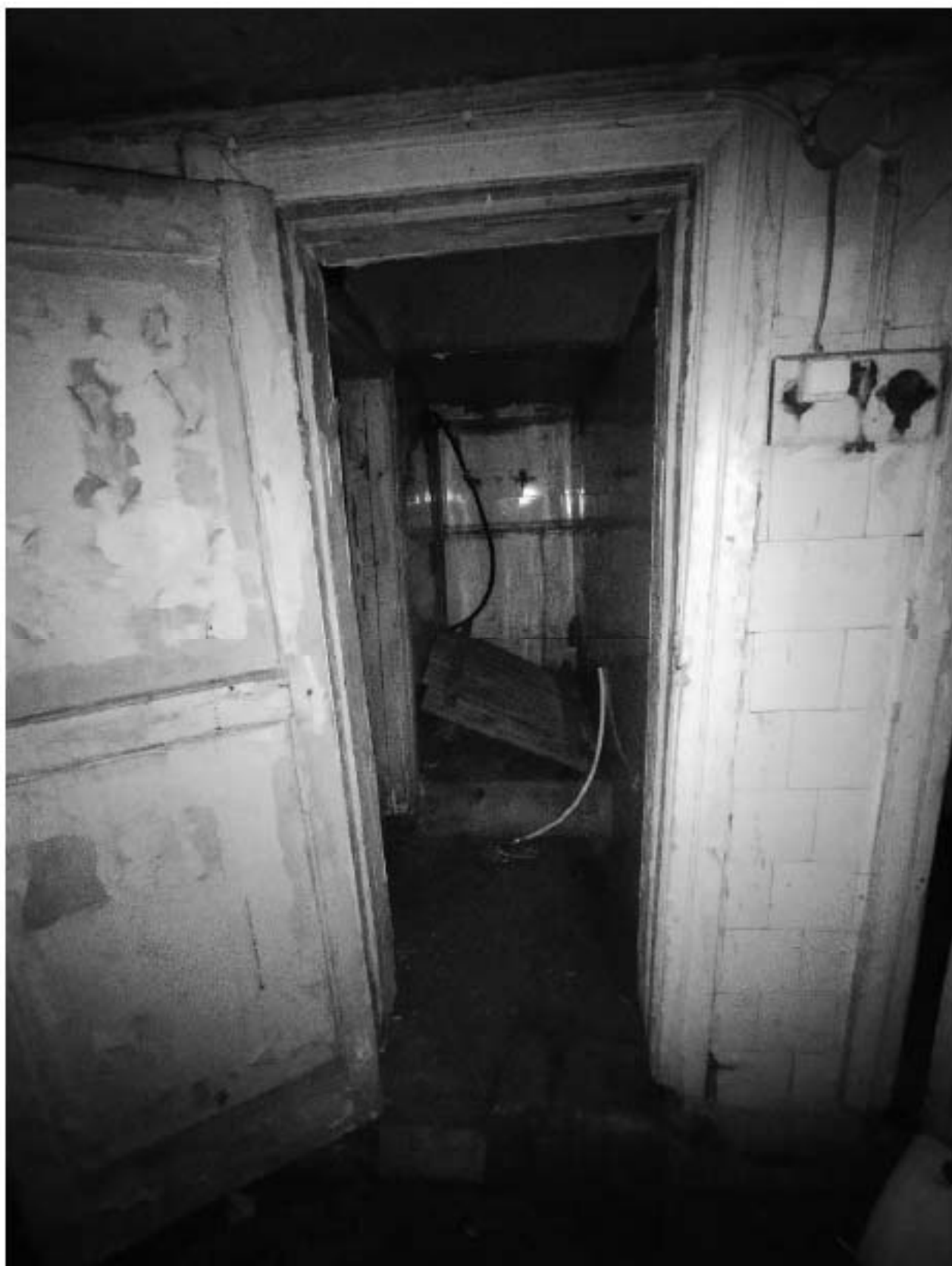
988. Подвал, помещение 6-Н. Вход в комнату 1,7 кв.м.
