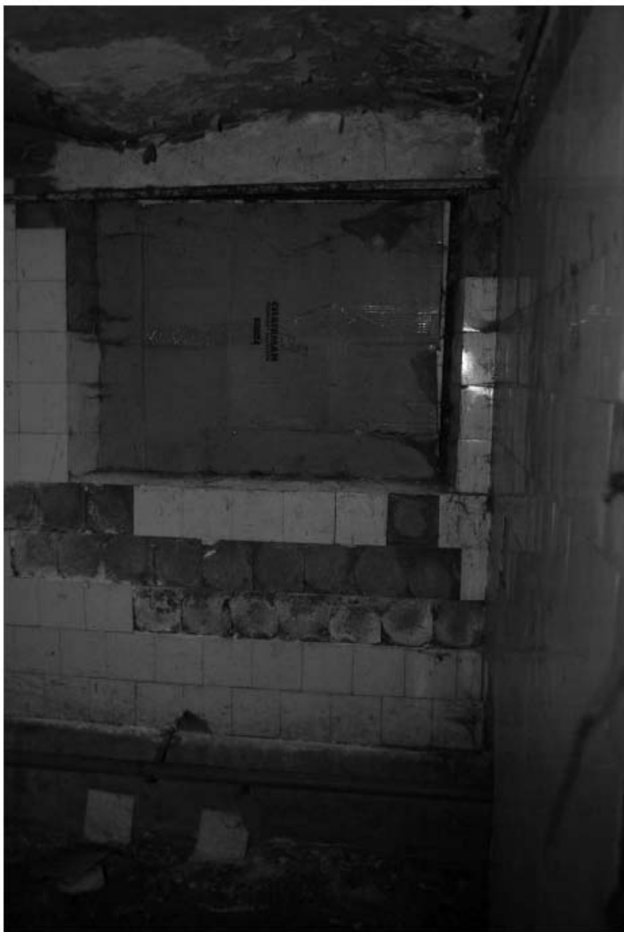
978. Подвал, помещение 6-Н. Интерьер комнаты 10,5 кв.м.
