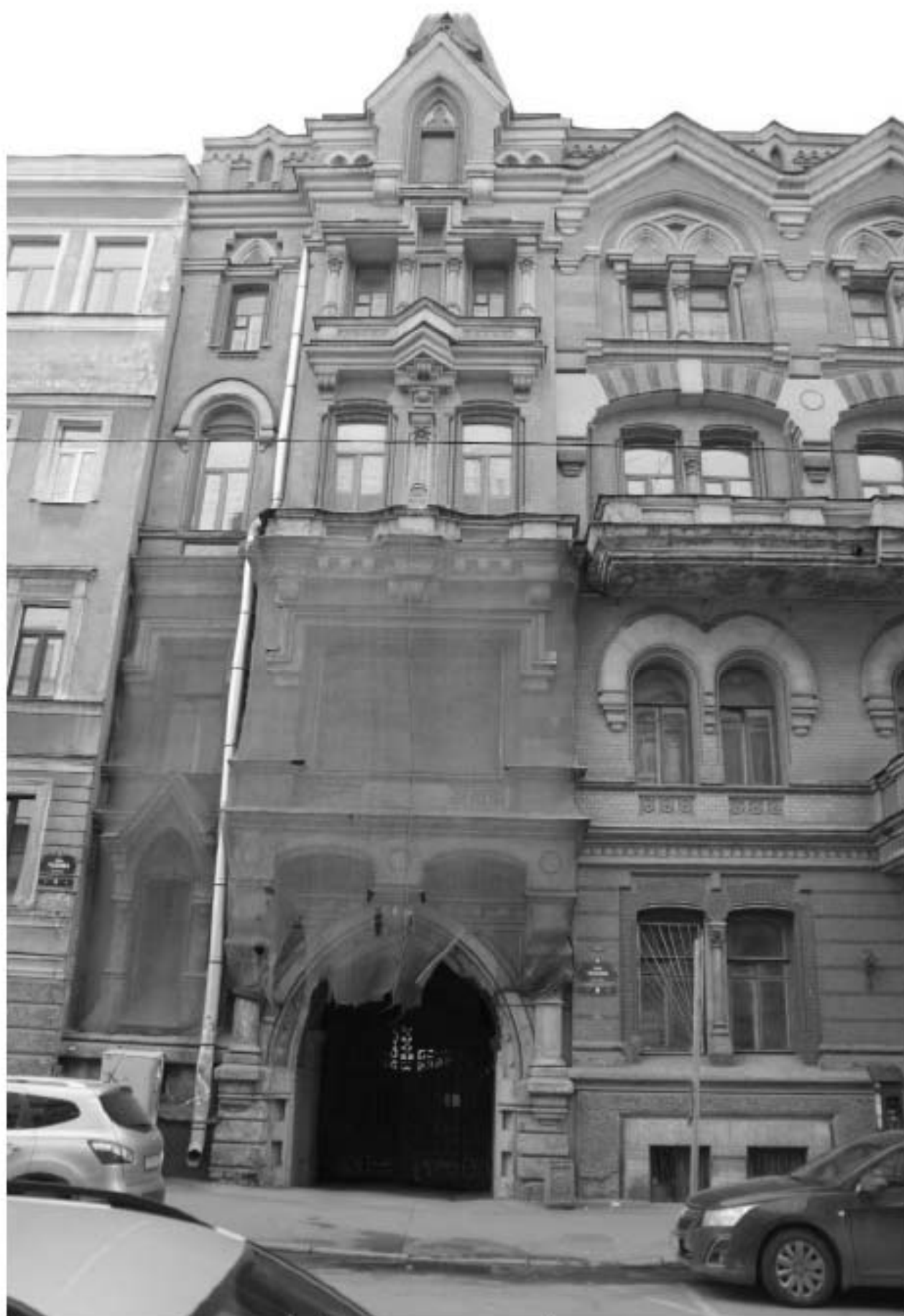
4. Фрагмент лицевого фасада.
