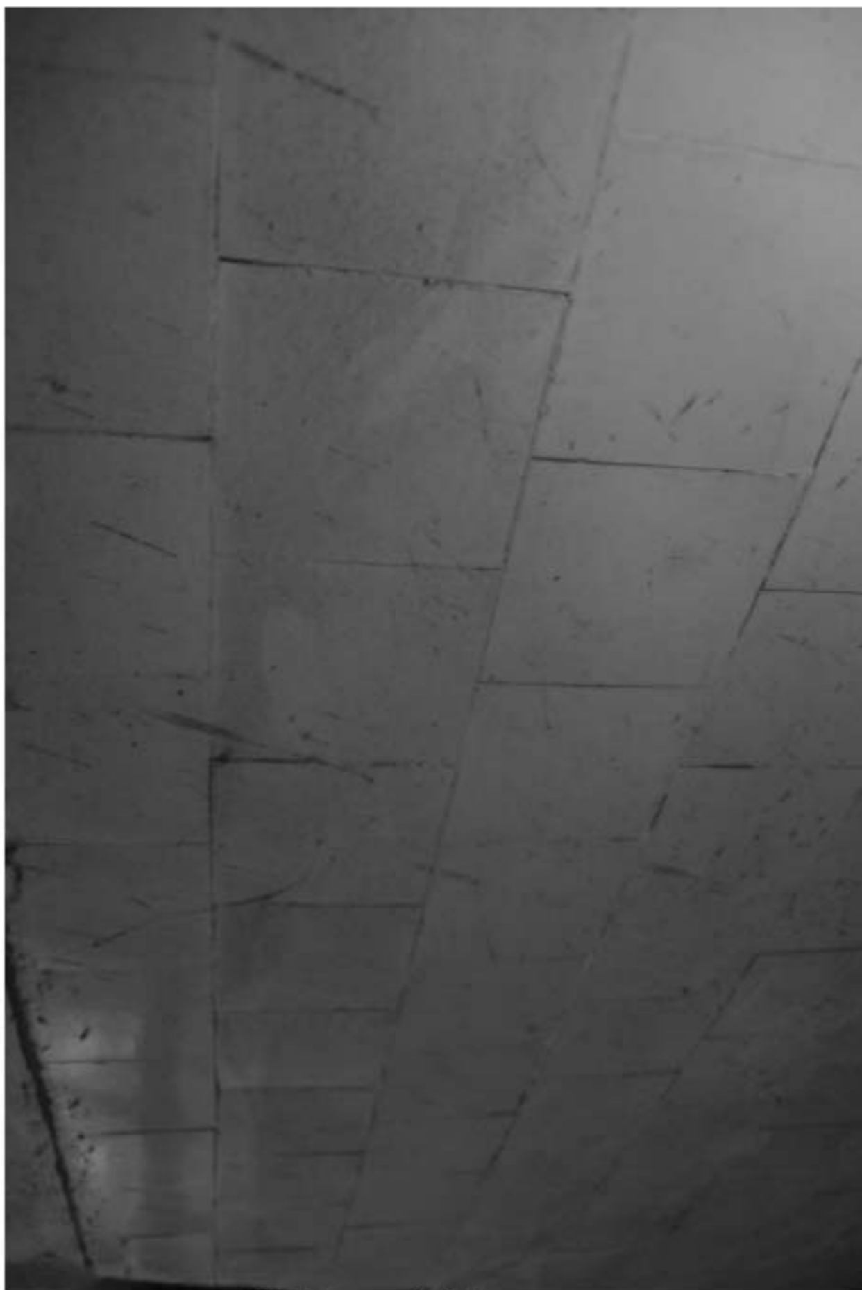
224. Лестница 4ЛК. Отделка стен.
