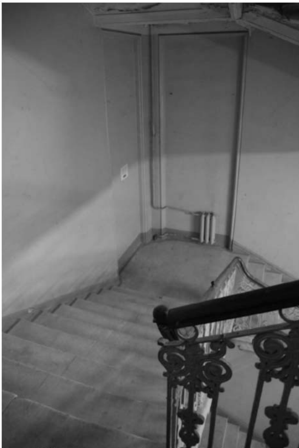
145. Вид на ниши лестничной площадки парадной лестницы.
