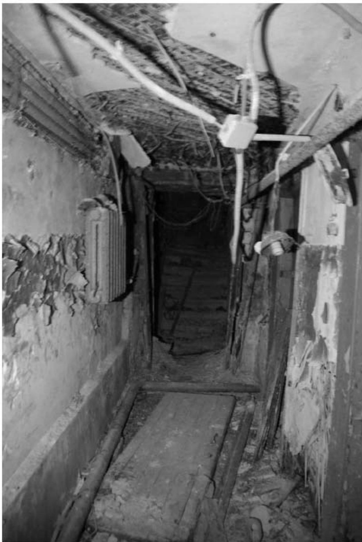
961. Подвал, помещение 6-Н. Вид на лестницу во двор.
