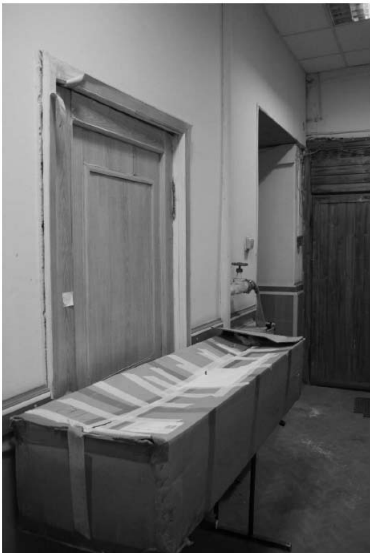
304. Этаж 1, помещение 20-Н. Вид коридора 13 кв.м.
