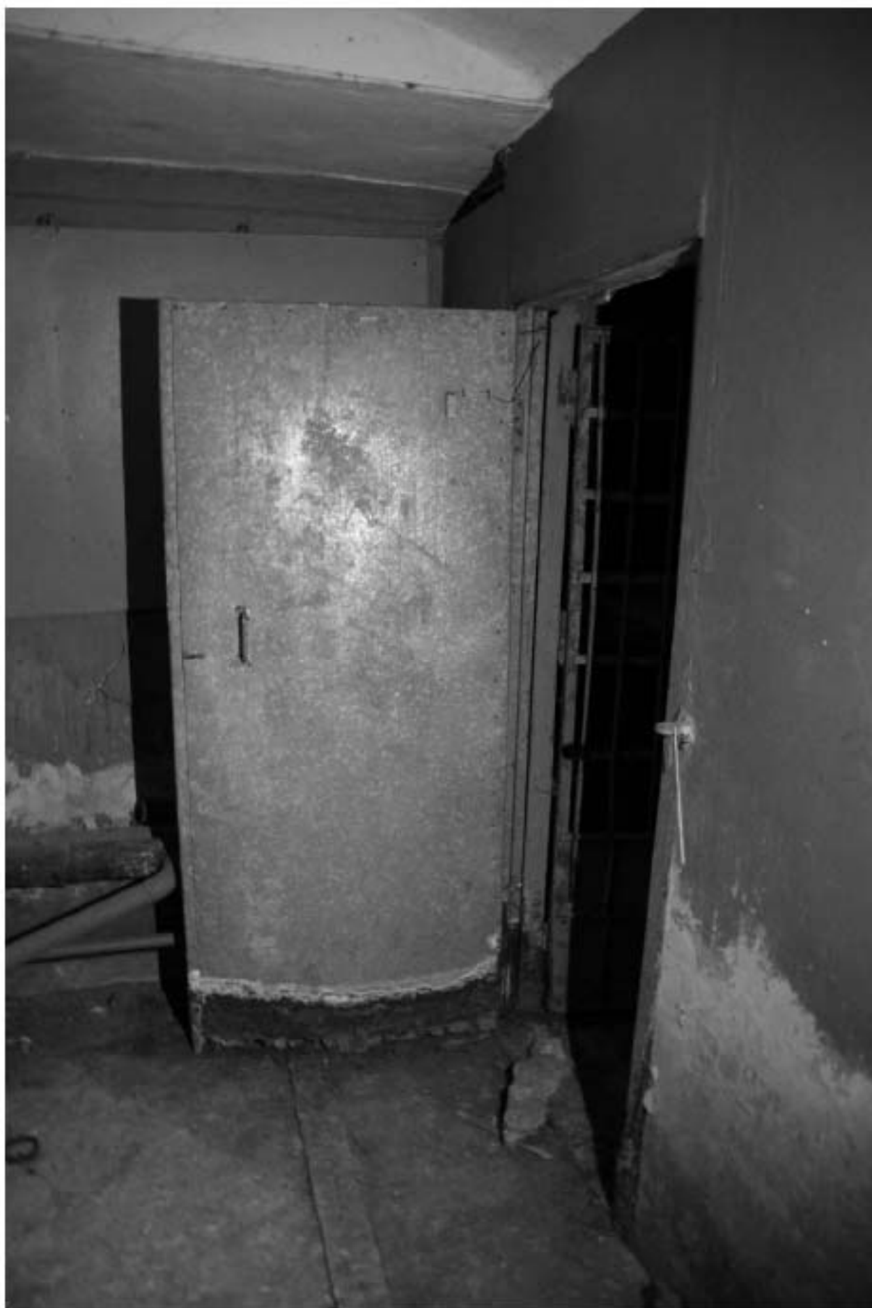
947. Подвал. Интерьер помещения 29-Н.
