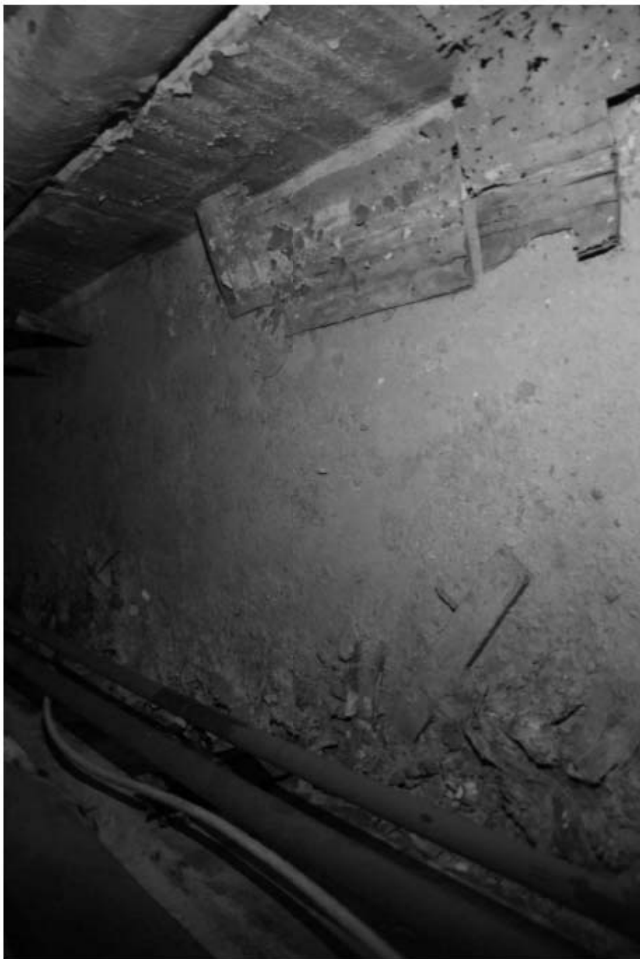
952. Подвал. Интерьер помещения 29-Н.
