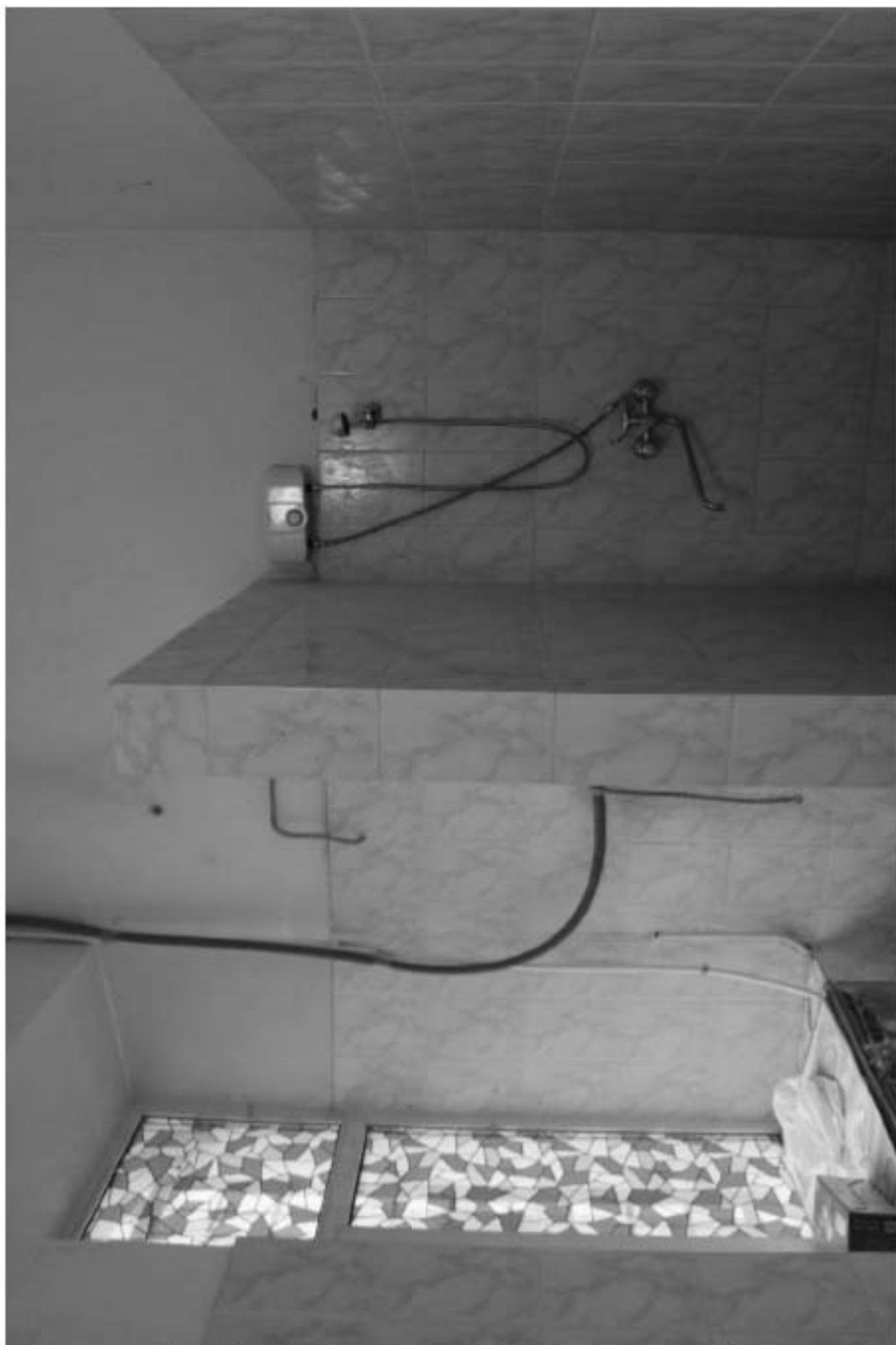
391. Этаж 1, помещение 15-Н. Интерьер душевой.
