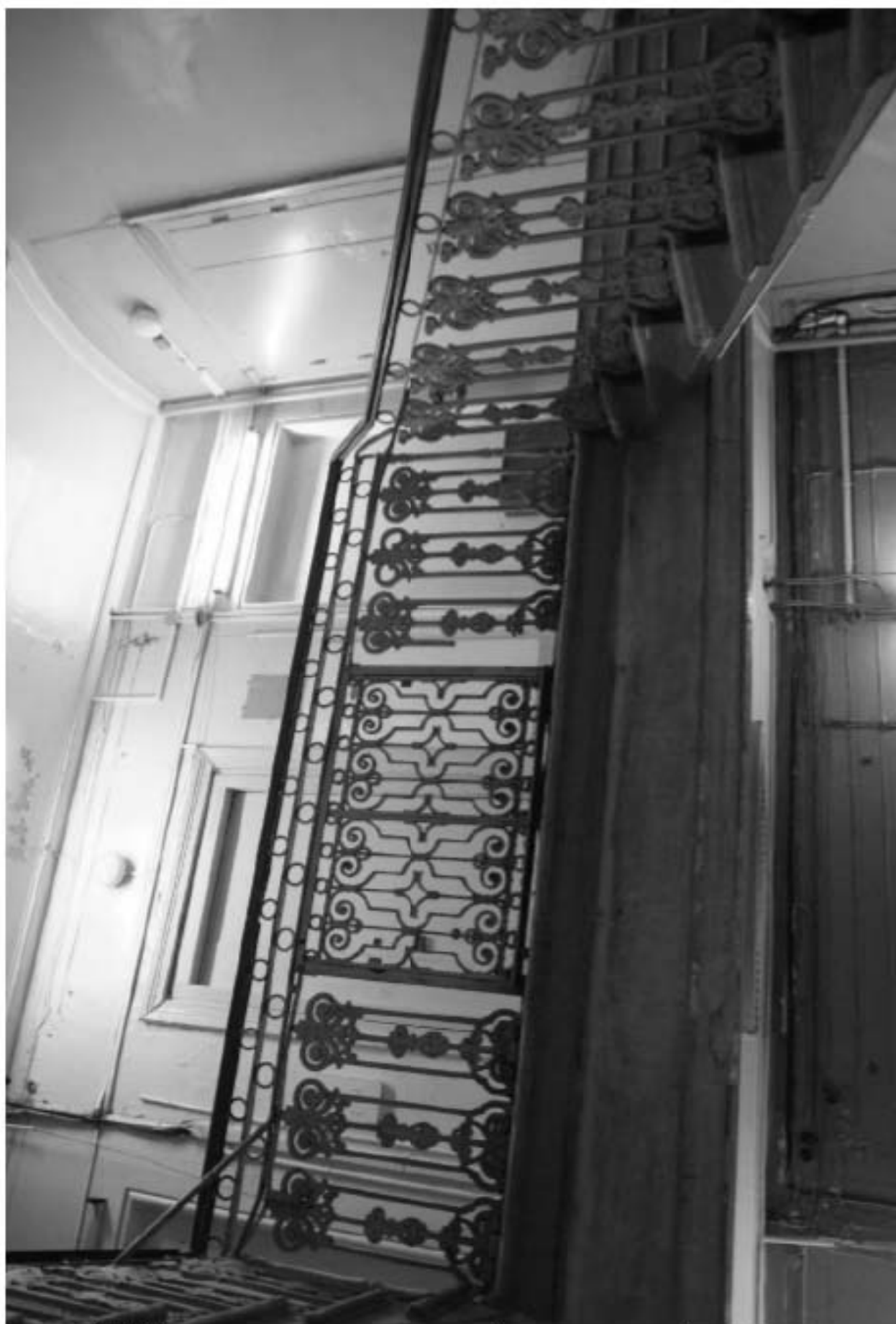
139. Вид на лестничную площадку 2 этажа парадной лестницы.
