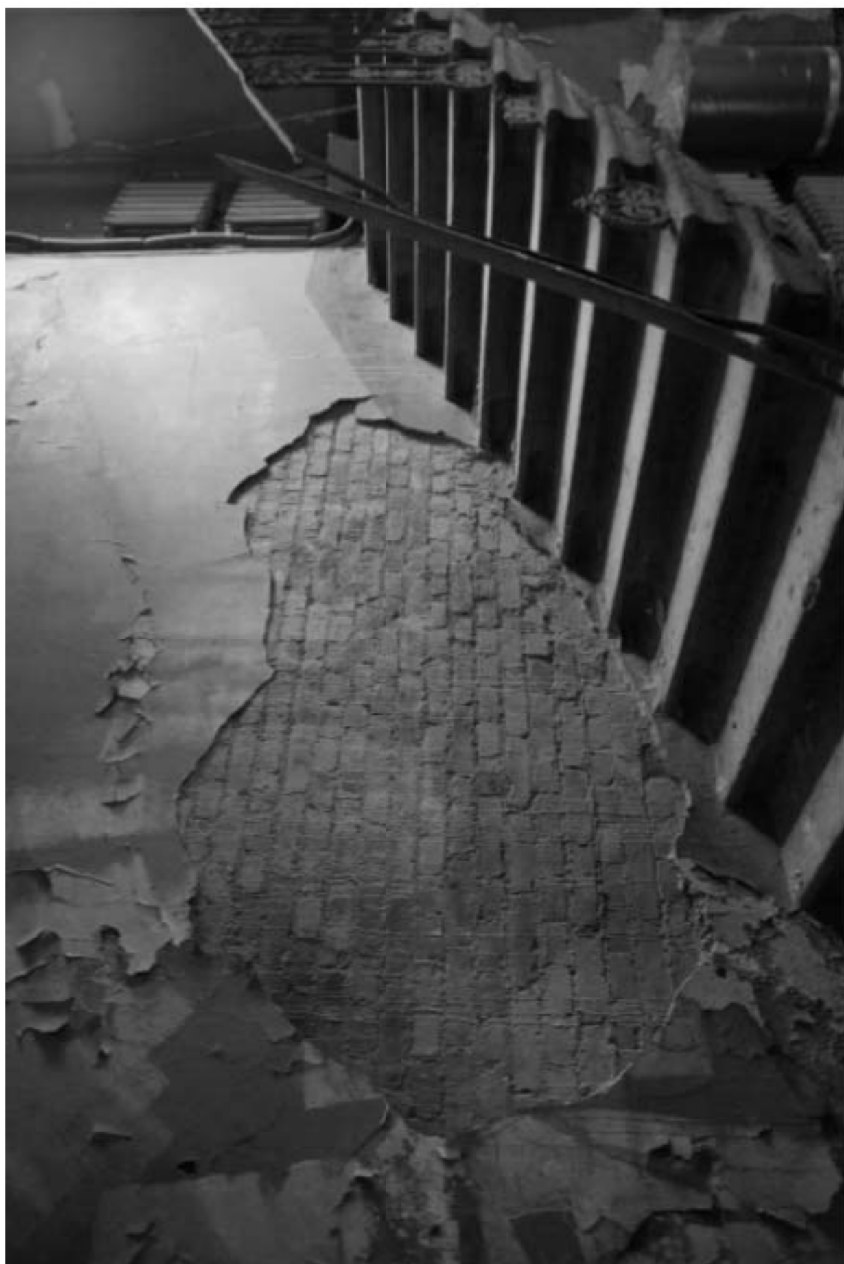
587. Лестница ЗЛК. Фрагмент.
