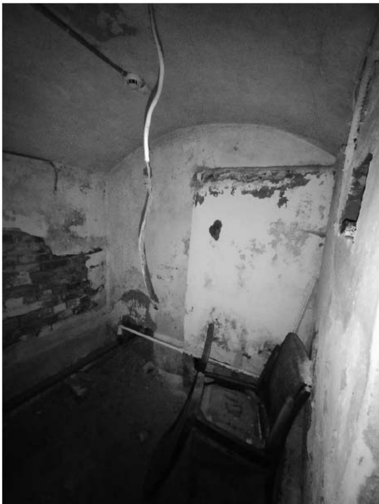
994. Подвал, помещение 6-Н. Интерьер комнаты 4,3 кв.м.
