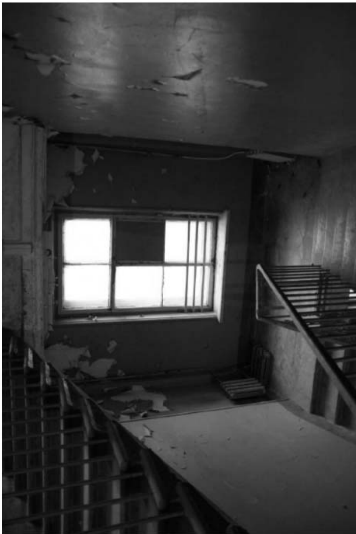
201. Лестница ЗЛК. Лестничная площадка между 3 и 4 этажами.
