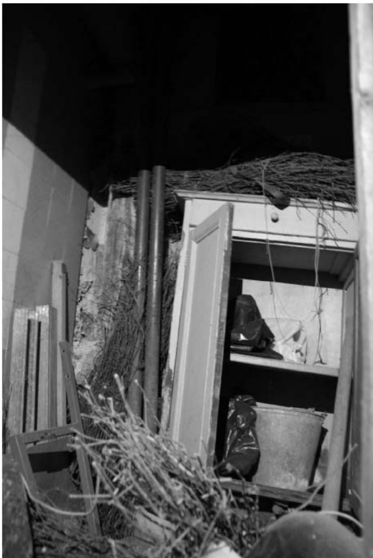
940. Подвал. Интерьер пространства под лестницей.
