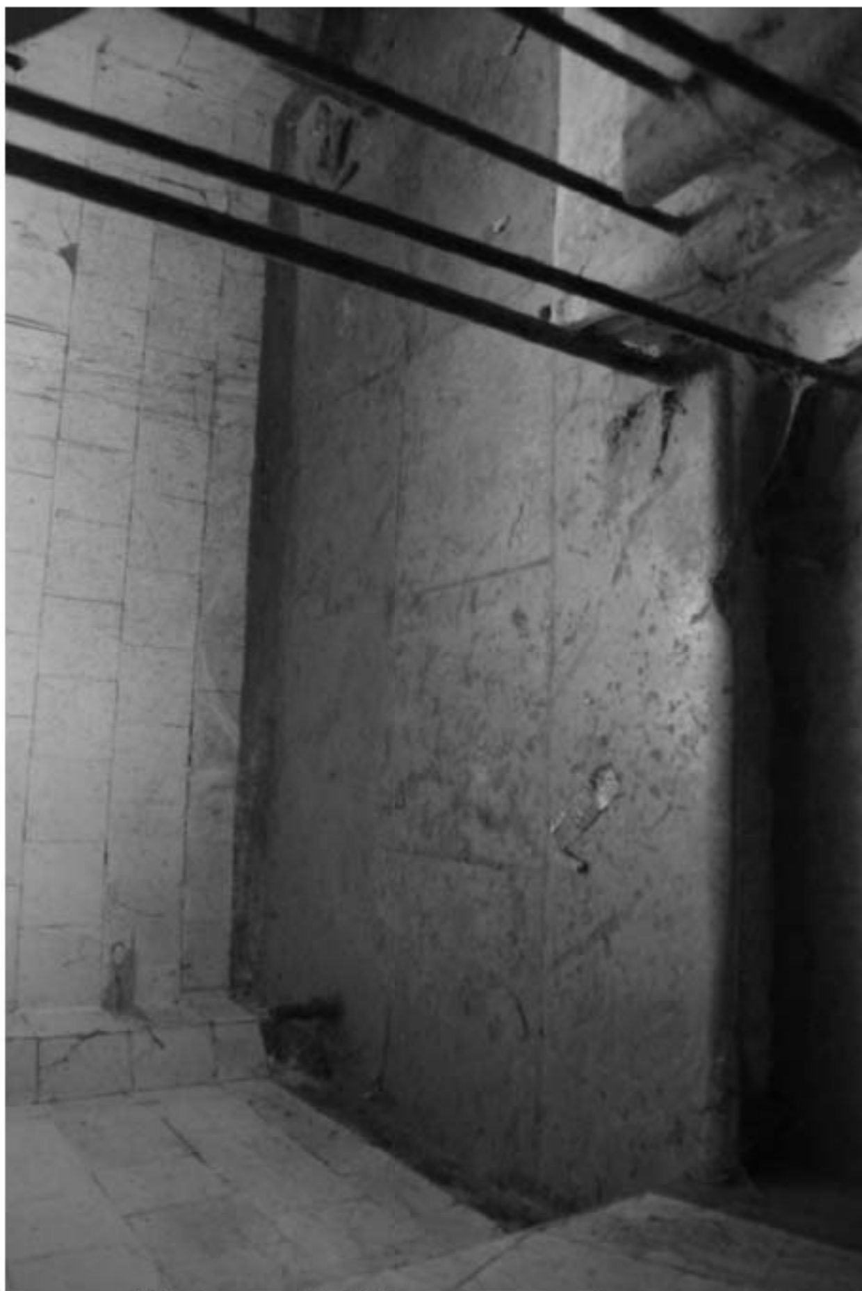
220. Лестница 4ЛК. Покрытие лестничной площадки.
