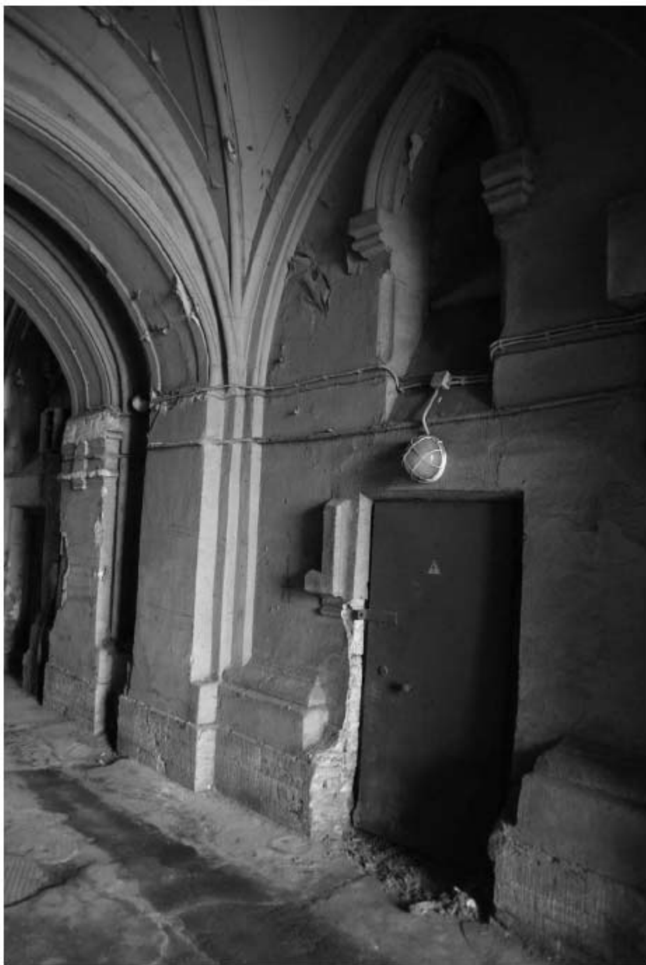
67. Воротный проезд лицевого корпуса. Фрагмент.
