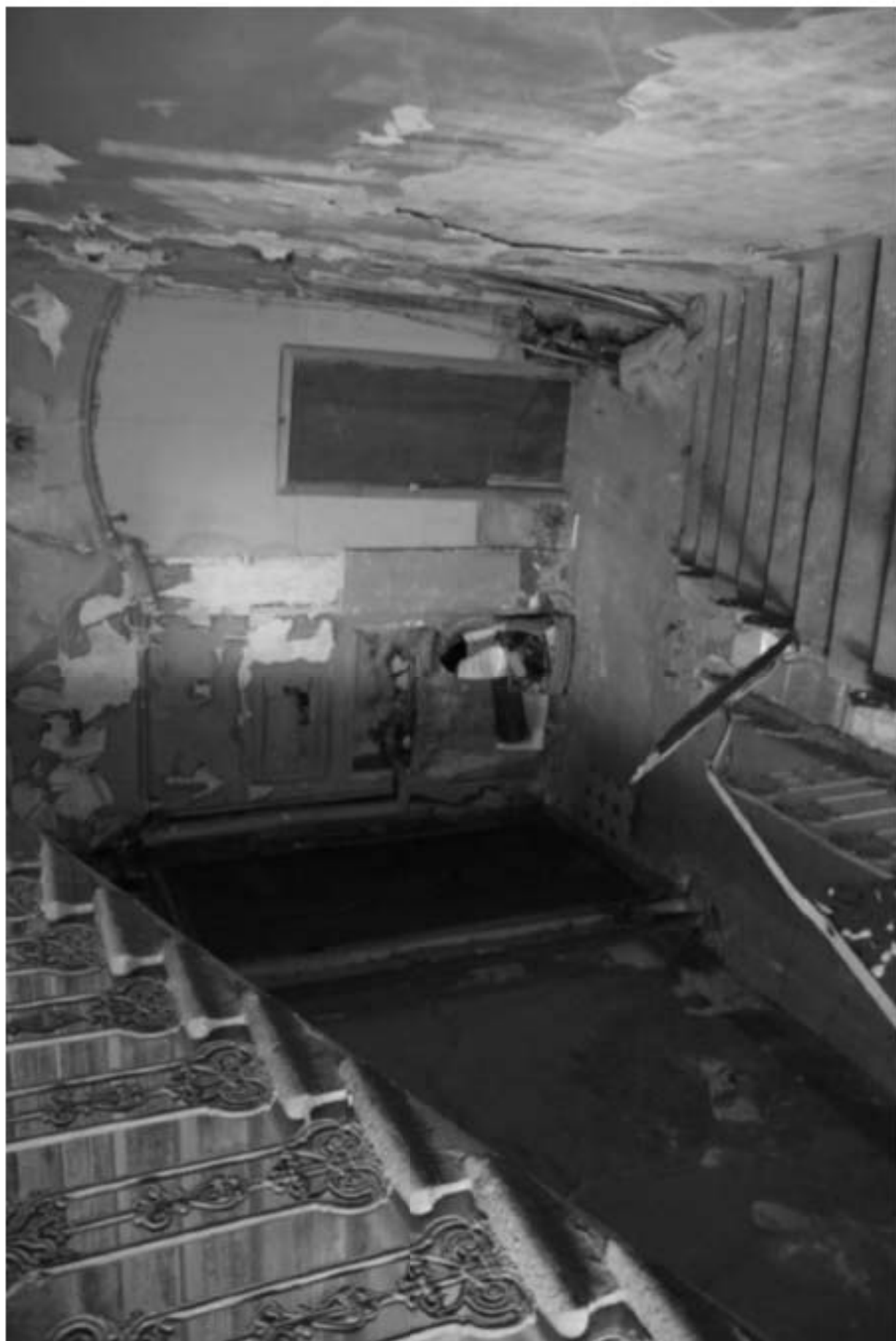
890. Лестница ЗЛК. Вид лестничную площадку 1 этажа.
