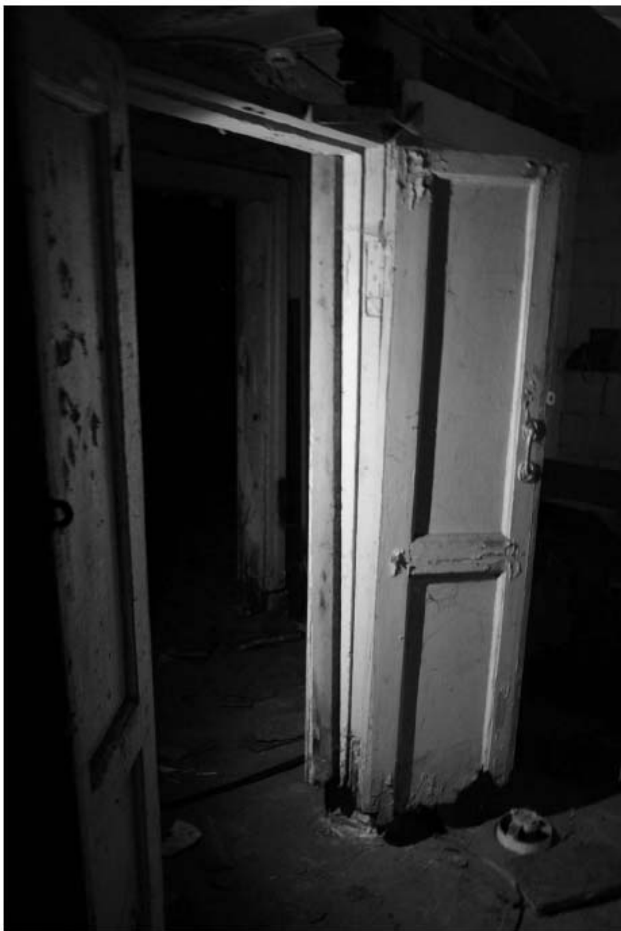
983. Подвал, помещение 6-Н. Двери комнаты 9,4 кв.м.
