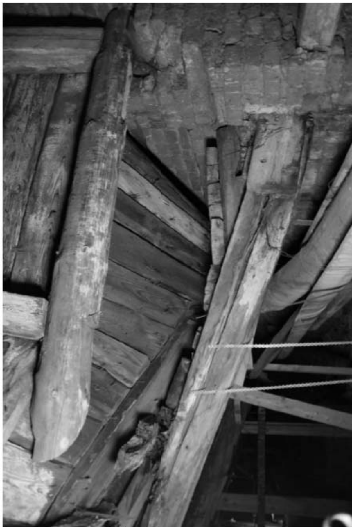
859. Этаж 5, интерьер чердака.
