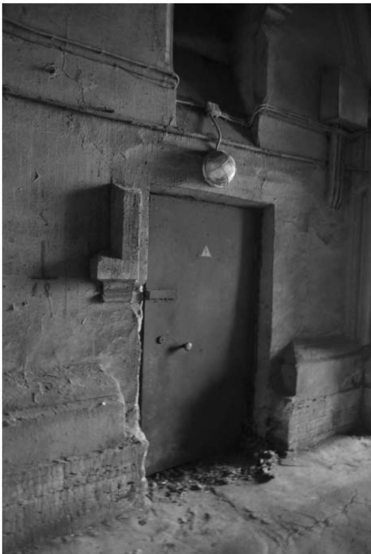
68. Воротный проезд лицевого корпуса. Фрагмент.
