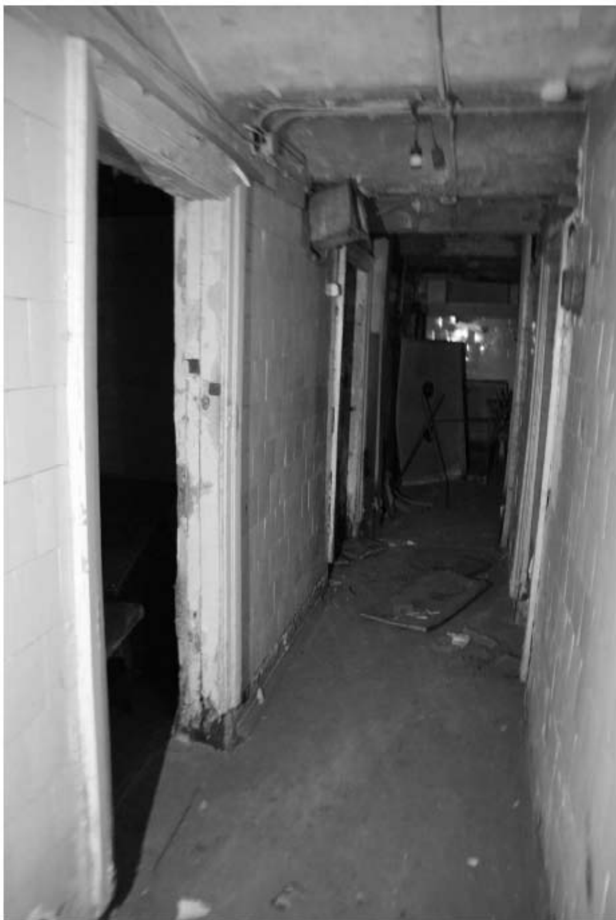
984. Подвал, помещение 6-Н. Вид коридора.
