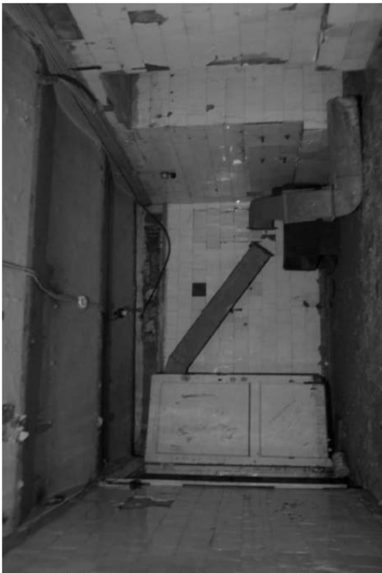
973. Подвал, помещение 6-Н. Интерьер комнаты 14,2 кв.м.
