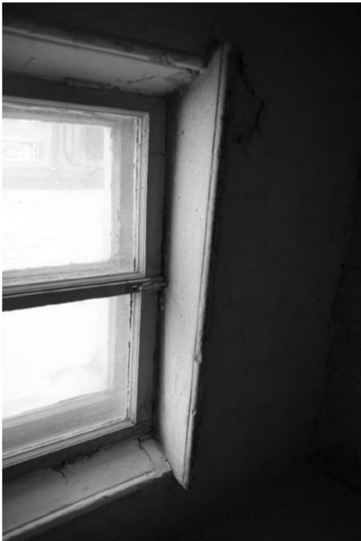
1074. Лестница 2ЛК. Вид деревянного профилированного подоконника.
