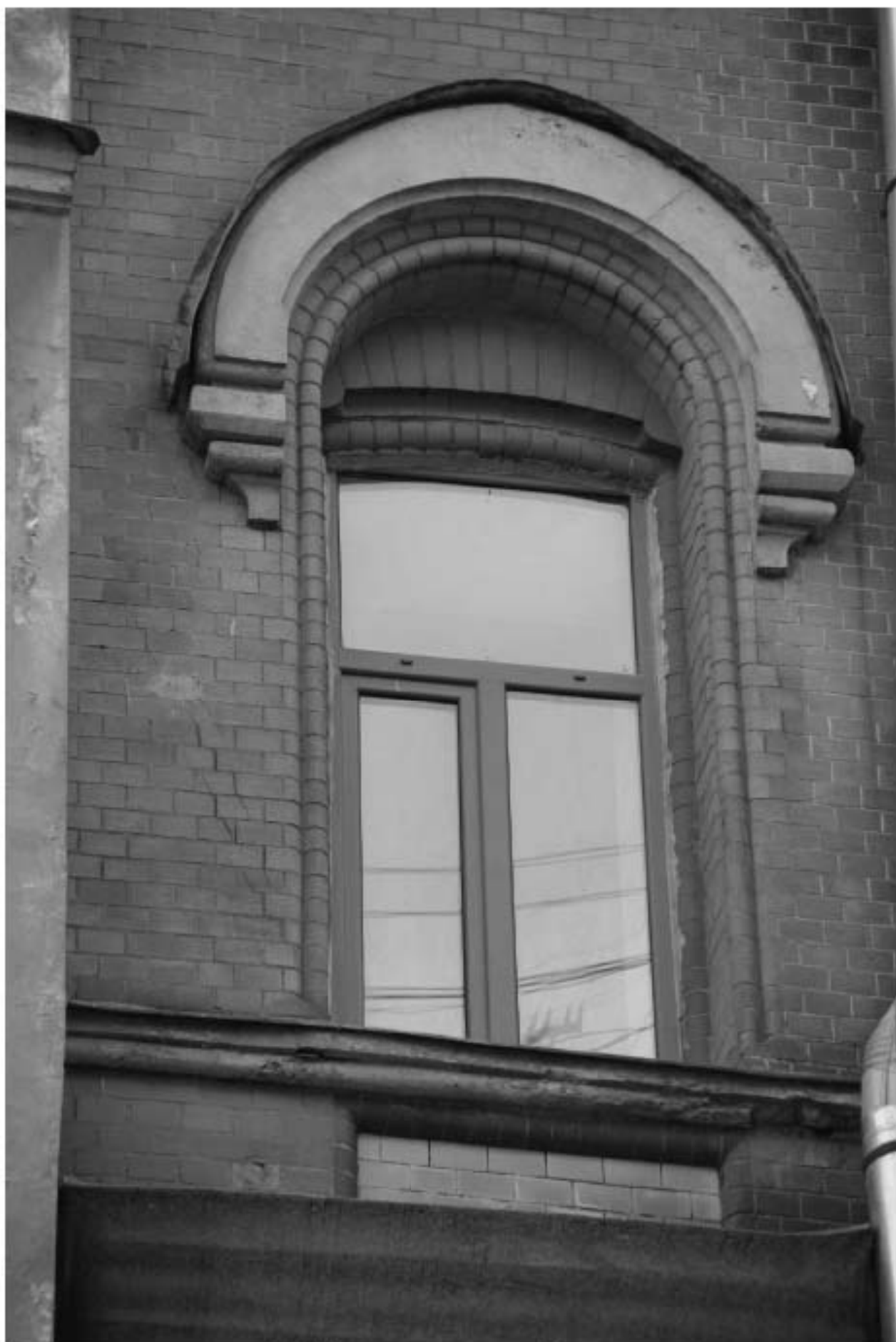
28. Фрагмент лицевого фасада.
