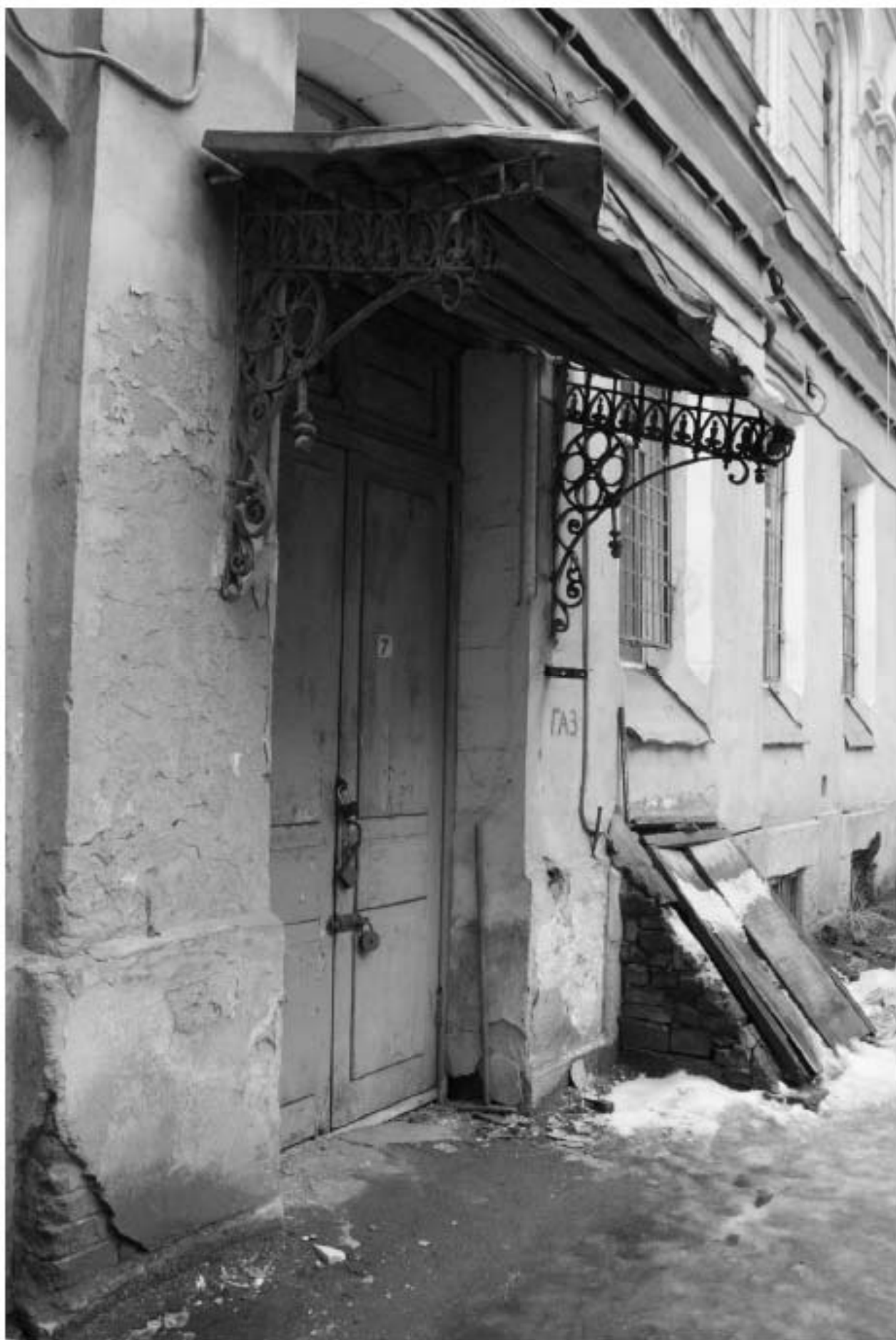
91. Дворовый фасад. Вид на козырёк.
