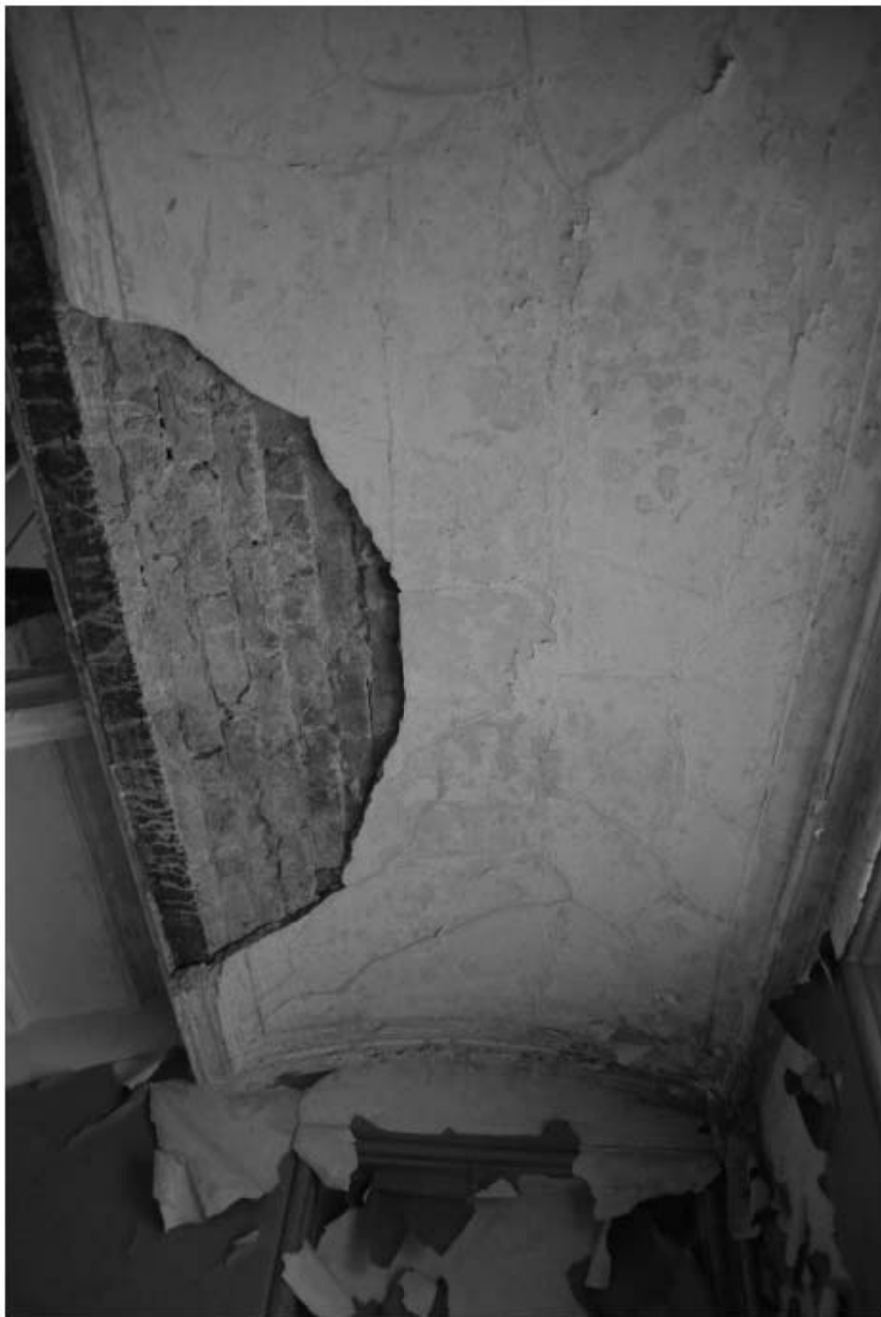
204. Лестница 3ЛК. Своды лестничной площадки.
