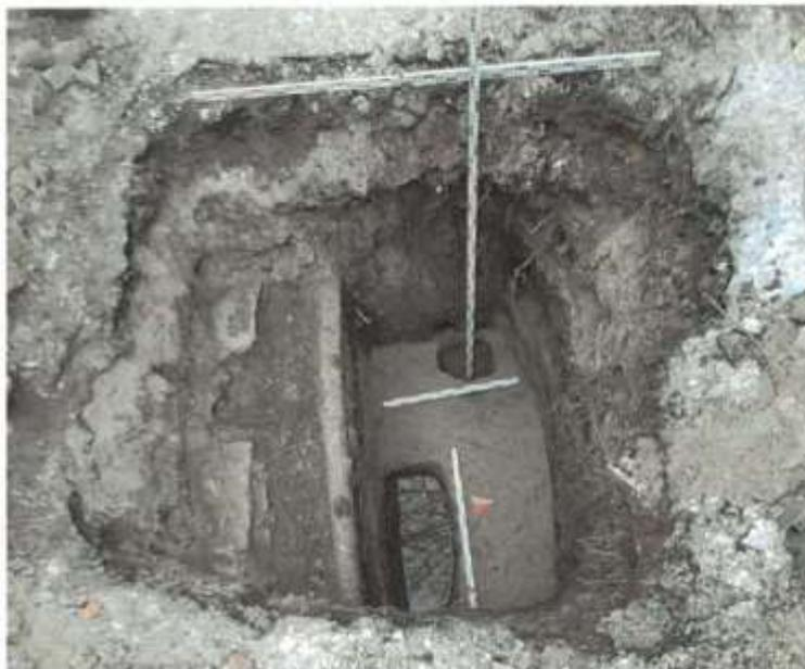
Рис.13. Санкт-Петербург, Нейшлотский пер. д. 3, лит. А. Шурф 1. Фиксация по светло-серой супеси с ожелезнением (материку) с контрольными проколами. Уровень остановки работ Вид на запад.
