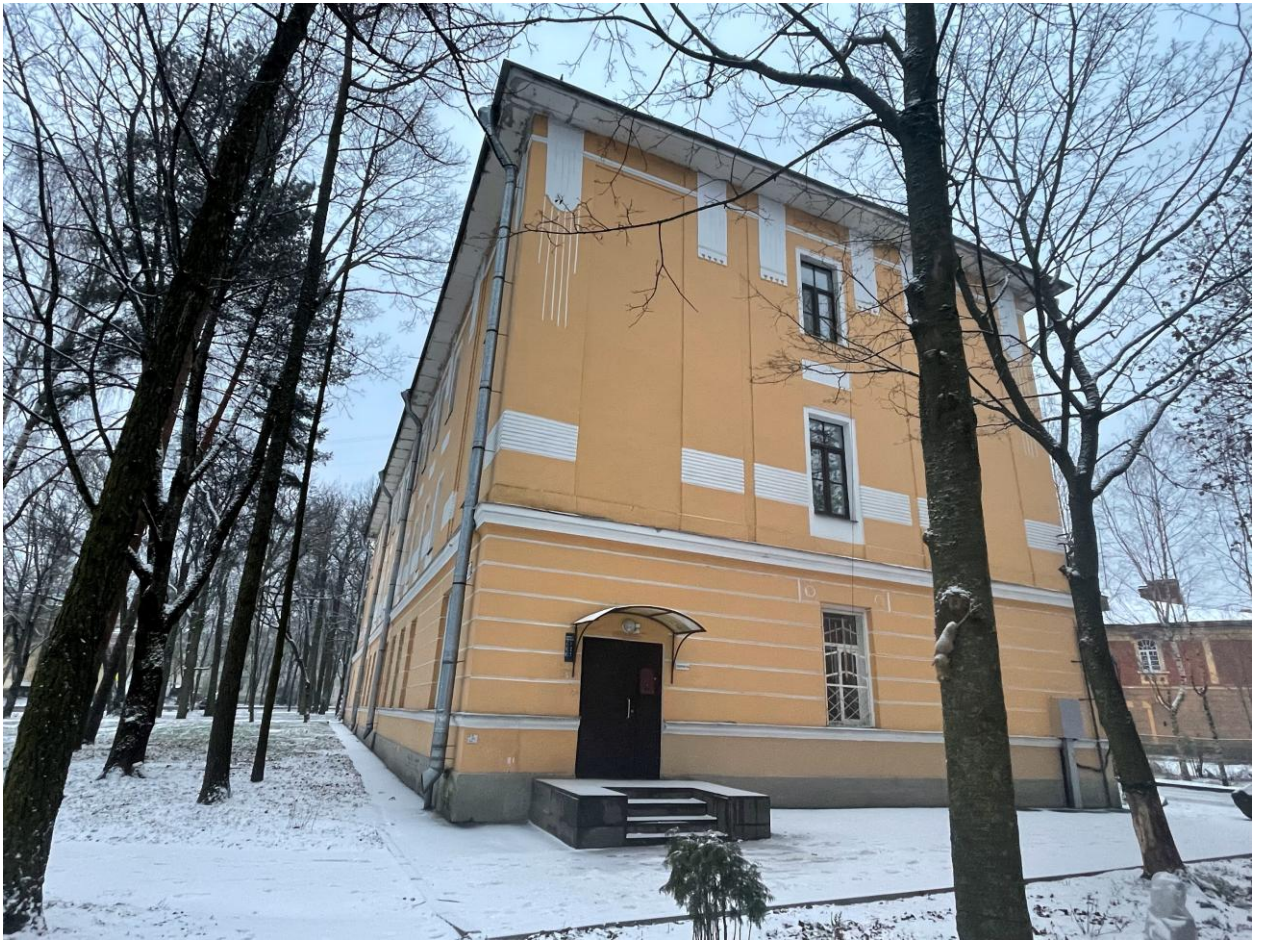
Фото 2. Торцевой фасад здания.
