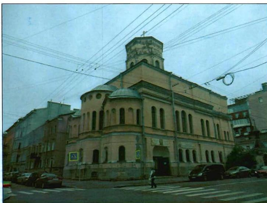
1. Общий вид с северо-востока.
