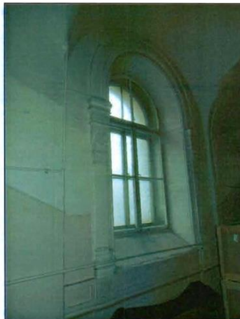
7. Центральный оконный проем парадной лестницы.
