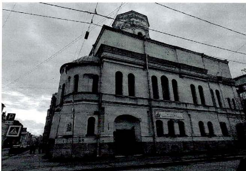
Общий вид лицевых фасадов.
