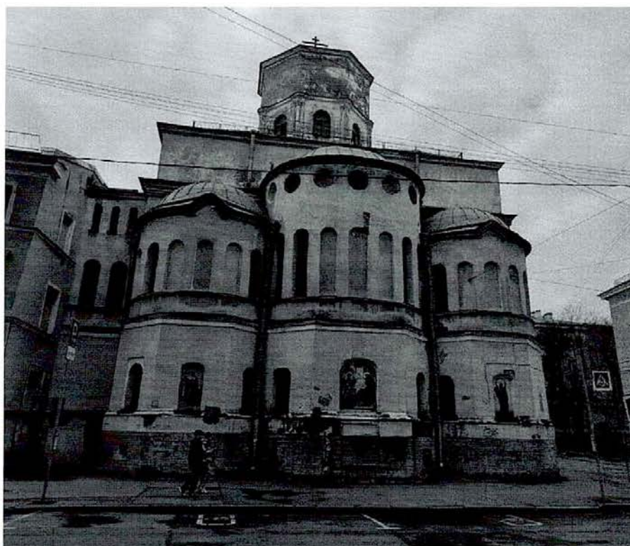
Общий вид лицевых фасадов.
