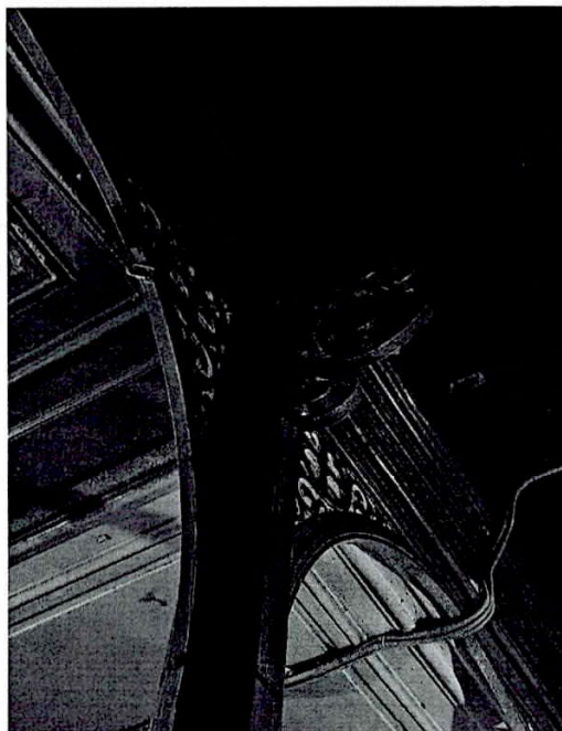
Фрагмент. Металлическая колонна.
