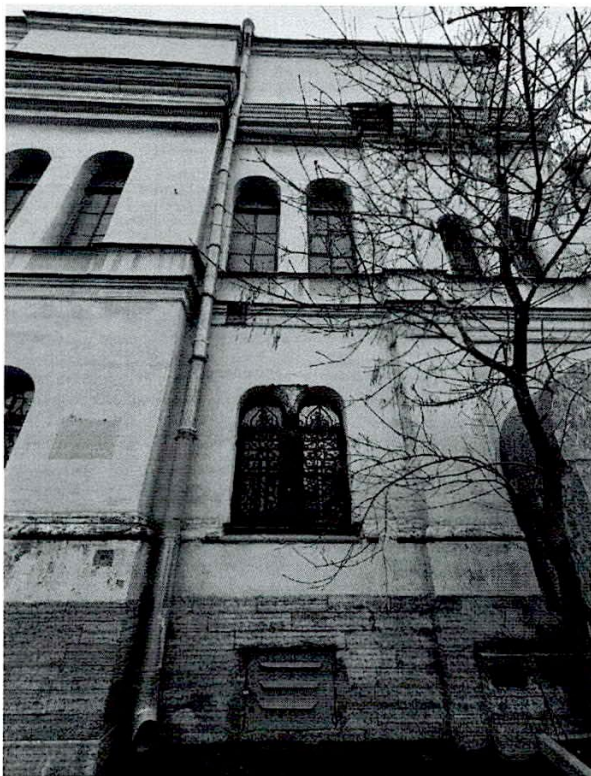
Фрагмент лицевого фасада.
