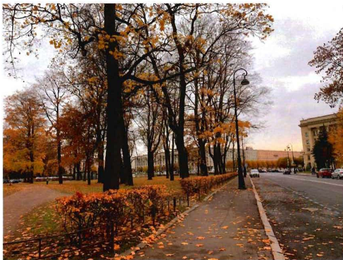
5. Фрагмент объекта культурного наследия с северной стороны (фото от 14.10.2022)
