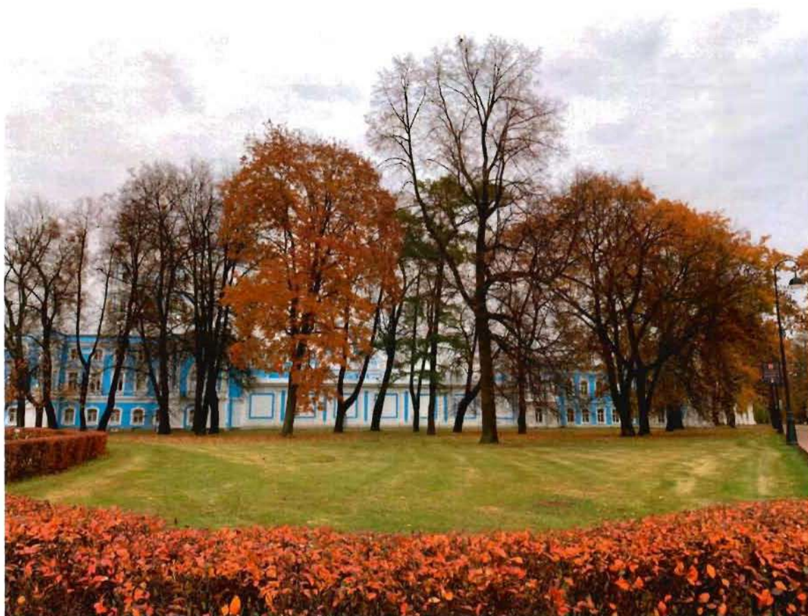
1. Фрагмент объекта культурного наследия с юго-западной стороны (фото от 14.10.2022)
