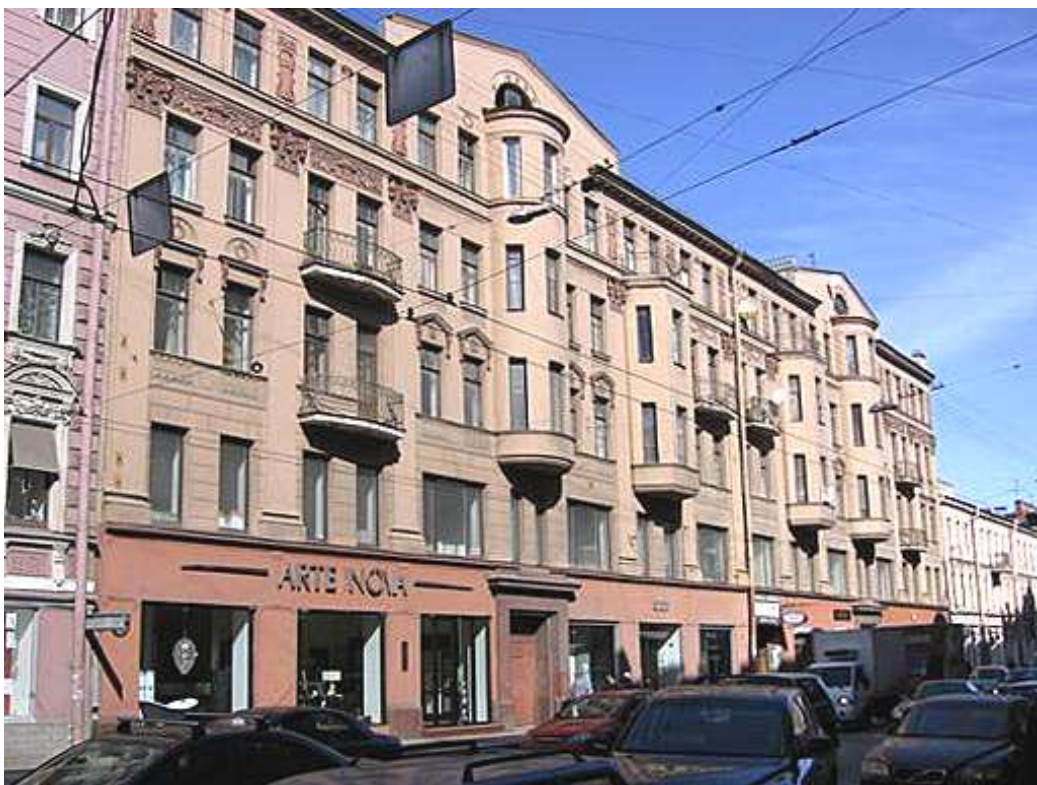
20. Большой пр. П.С., дом 22-24. Главный фасад. Фотоснимок 2009 г.
